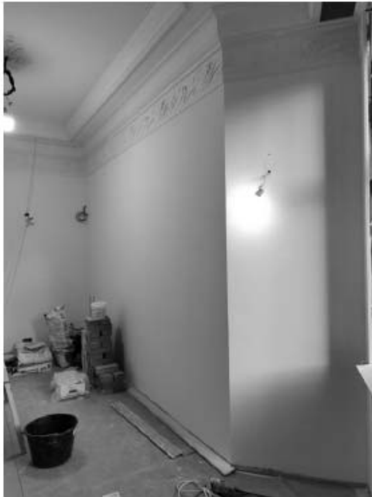
30. Объект культурного наследия регионального значения «Дом М.П. Толстого» (г. Санкт-Петербург, Фонтанки р. наб., 54; Рубинштейна ул., 15-17). Помещение квартиры № 563.
