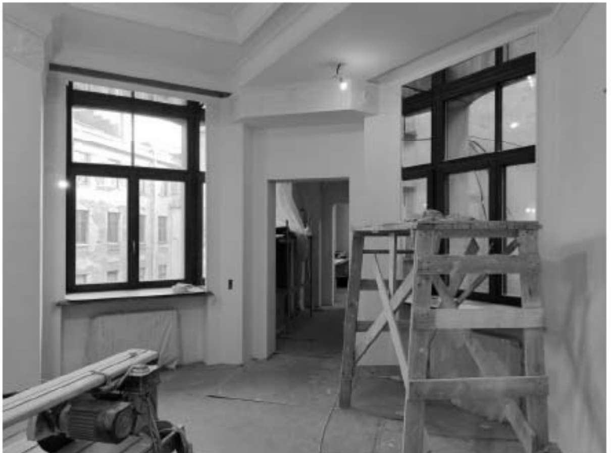
32. Объект культурного наследия регионального значения «Дом М.П. Толстого» (г. Санкт-Петербург, Фонтанки р. наб., 54; Рубинштейна ул., 15-17). Помещение квартиры № 563.
