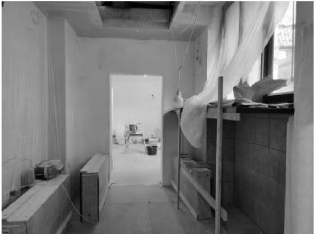
27. Объект культурного наследия регионального значения «Дом М.П. Толстого» (г. Санкт-Петербург, Фонтанки р. наб., 54; Рубинштейна ул., 15-17). Помещение квартиры № 563.
