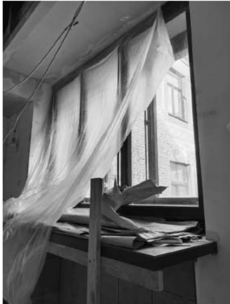
29. Объект культурного наследия регионального значения «Дом М.П. Толстого» (г. Санкт-Петербург, Фонтанки р. наб., 54; Рубинштейна ул., 15-17). Помещение квартиры № 563.
