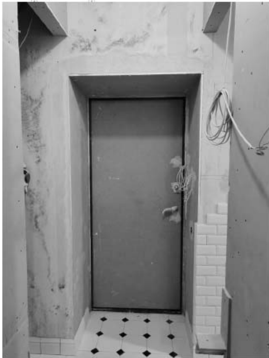
19. Объект культурного наследия регионального значения «Дом М.П. Толстого» (г. Санкт-Петербург, Фонтанки р. наб., 54; Рубинштейна ул., 15-17). Помещение квартиры № 563.
