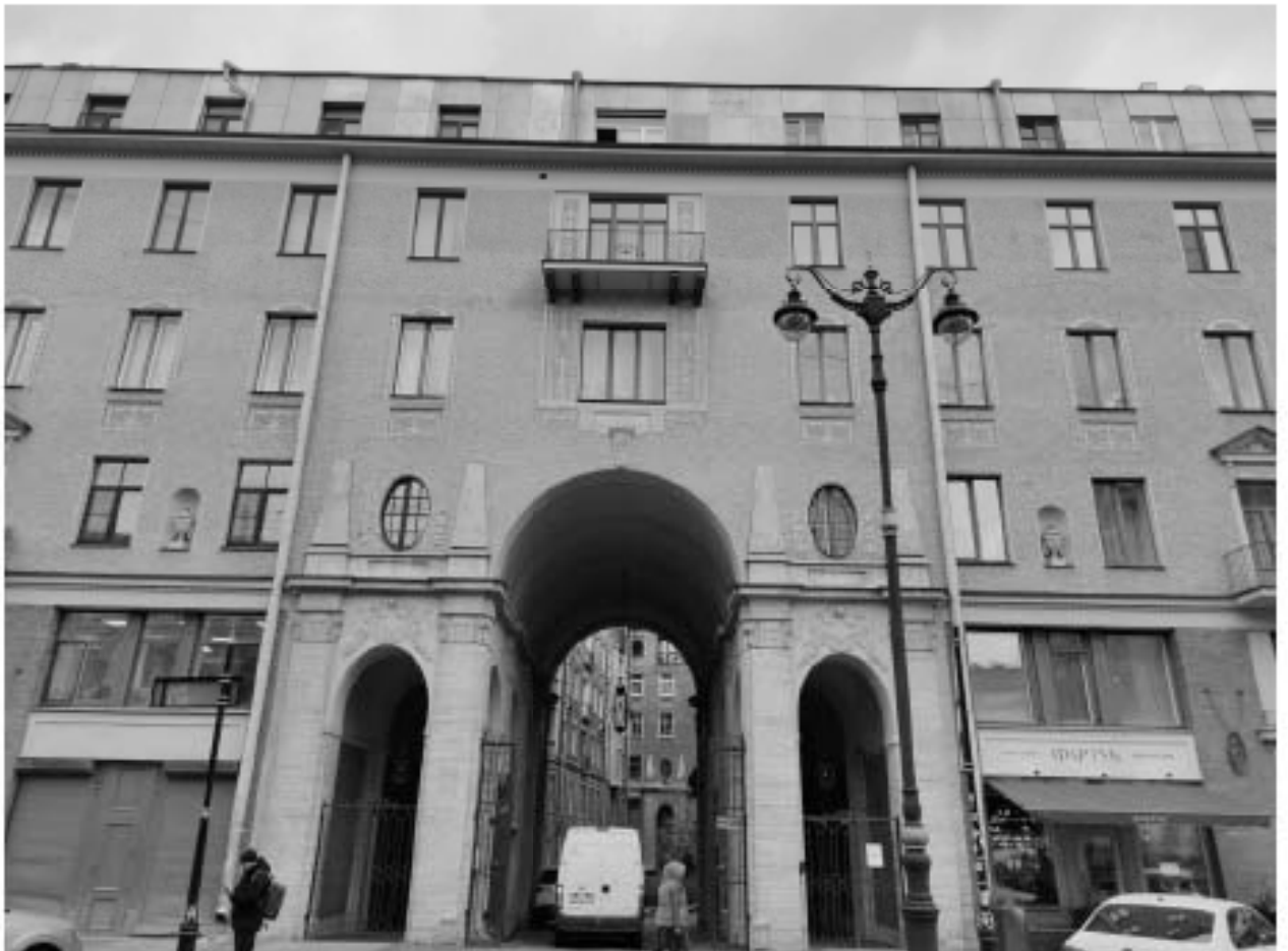
12. Объект культурного наследия регионального значения «Дом М.П. Толстого» (г. Санкт-Петербург, Фонтанки р. наб., 54; Рубинштейна ул., 15-17). Лицевой фасад по улице Рубинштейна.
