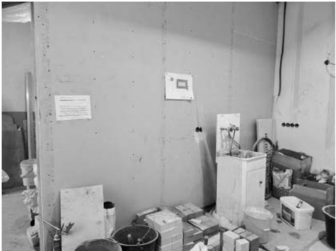
24. Объект культурного наследия регионального значения «Дом М.П. Толстого» (г. Санкт-Петербург, Фонтанки р. наб., 54; Рубинштейна ул., 15-17). Помещение квартиры № 563.
