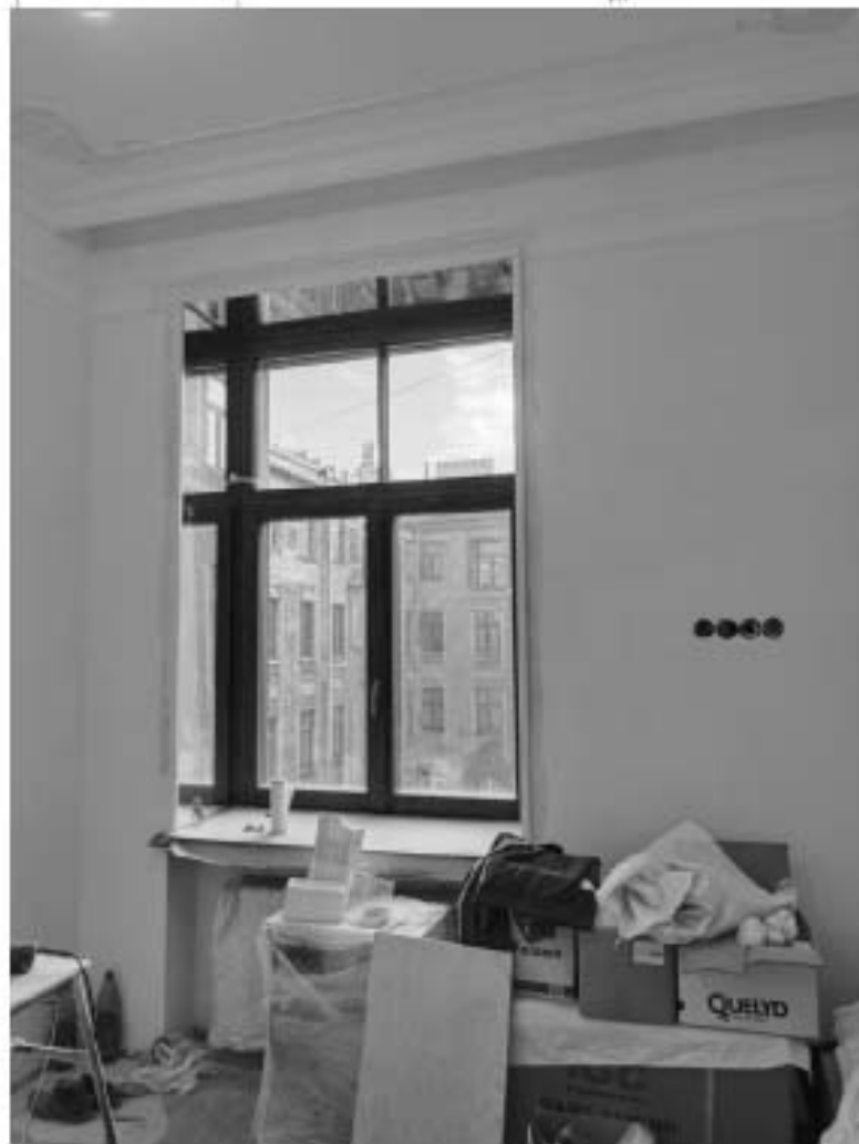
44. Объект культурного наследия регионального значения «Дом М.П. Толстого» (г. Санкт-Петербург, Фонтанки р. наб., 54; Рубинштейна ул., 15-17). Помещение квартиры № 563.
