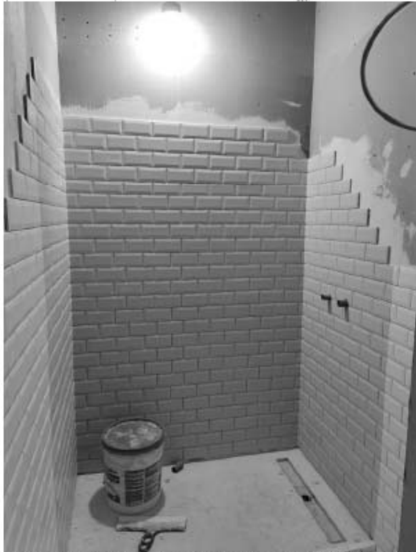
20. Объект культурного наследия регионального значения «Дом М.П. Толстого» (г. Санкт-Петербург, Фонтанки р. наб., 54; Рубинштейна ул., 15-17). Помещение квартиры № 563.
