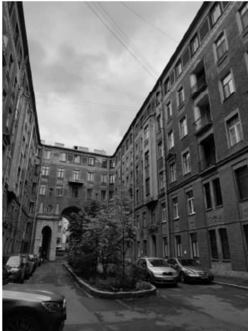
8. Объект культурного наследия регионального значения «Дом М.П. Толстого» (г. Санкт-Петербург, Фонтанки р. наб., 54; Рубинштейна ул., 15-17). Парадный двор.
