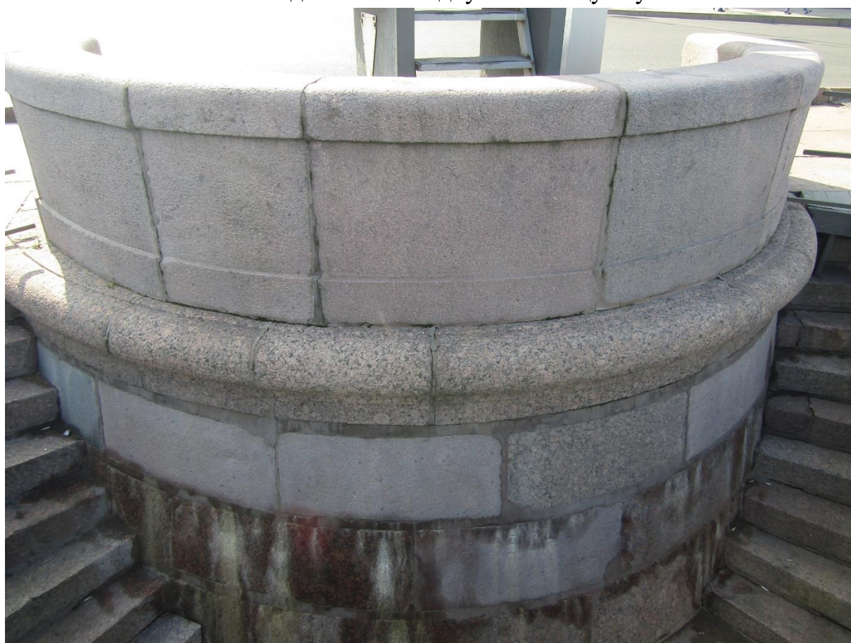
Фото 12. Вид на полукруглую подпорную стенку (ризалит) и парапет спуска № 4.
