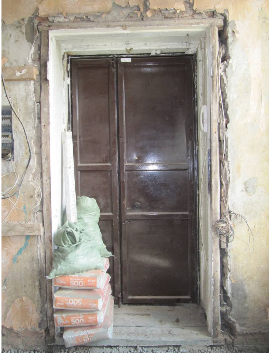
4. Вид на вход в помещение квартиры №77.
