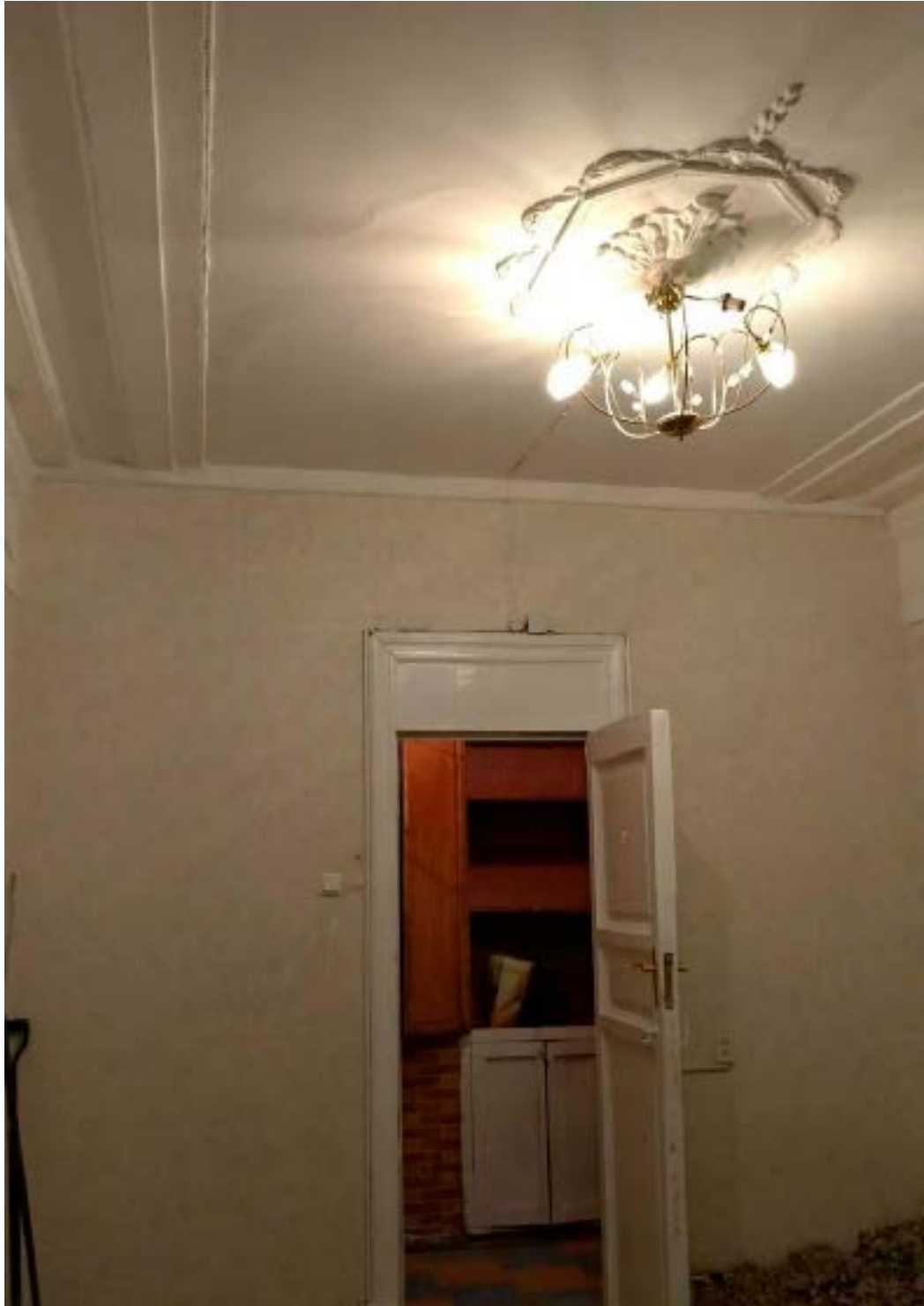
12. Помещение №3 кв. №2 в уровне 2-го этажа объекта культурного наследия регионального значения «Дом Т.П. Павловой», расположенного по адресу: г. Санкт-Петербург, Конная ул., д. 8, литера А. 05.03.2021.
