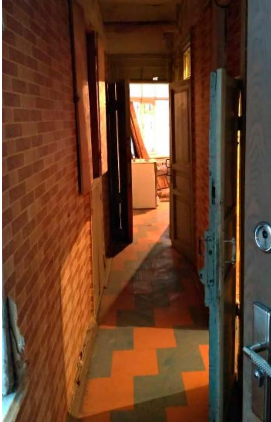
19. Помещение №11 кв. №2 в уровне 2-го этажа объекта культурного наследия регионального значения «Дом Т.П. Павловой», расположенного по адресу: г. Санкт-Петербург, Конная ул., д. 8, литера А. 05.03.2021.
