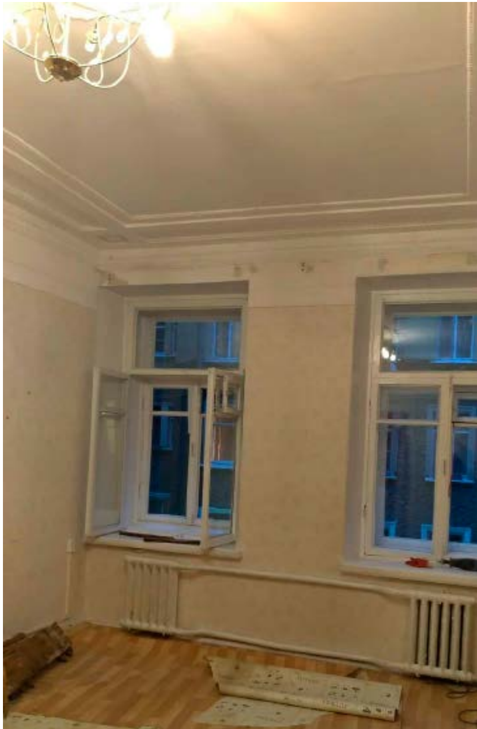
11. Помещение №3 кв. №2 в уровне 2-го этажа объекта культурного наследия регионального значения «Дом Т.П. Павловой», расположенного по адресу: г. Санкт-Петербург, Конная ул., д. 8, литера А. 05.03.2021.
