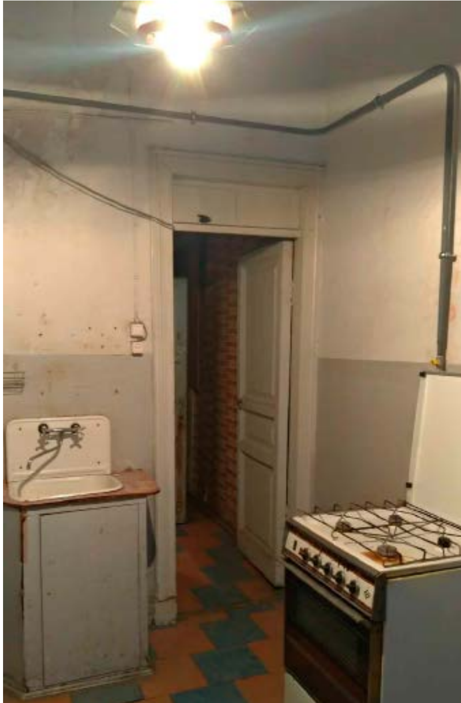
17. Помещение №10 кв. №2 в уровне 2-го этажа объекта культурного наследия регионального значения «Дом Т.П. Павловой», расположенного по адресу: г. Санкт-Петербург, Конная ул., д. 8, литера А. 05.03.2021.
