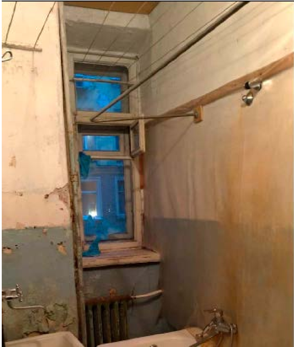
16. Помещение №7 кв. №2 в уровне 2-го этажа объекта культурного наследия регионального значения «Дом Т.П. Павловой», расположенного по адресу: г. Санкт-Петербург, Конная ул., д. 8, литера А. 05.03.2021.
