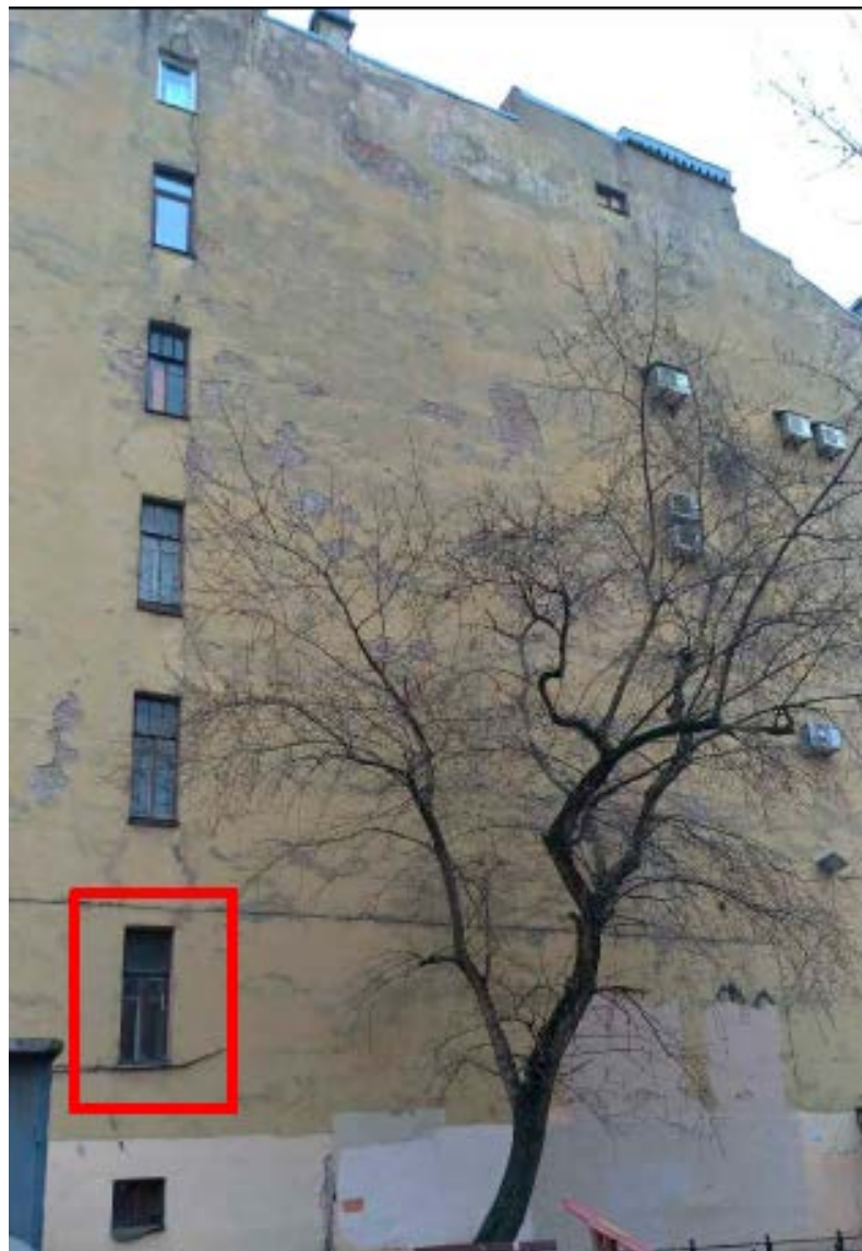
3. Оконное заполнение кв. №2 в уровне 2-го этажа дворового фасада объекта культурного наследия регионального значения «Дом Т.П. Павловой». 05.03.2021.
