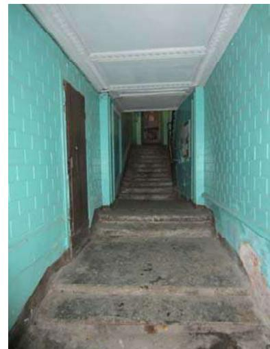
парадная лестница со стороны Загородного пр. – конфигурация, габариты, местоположение, тип (двухмаршевая), конструкция (по косоурам), вид материала ступеней (известняк); ограждение – вид материала (черный металл), техника исполнения (литье), рисунок; поручни – конфигурация, габариты, вид материала (дерево);
