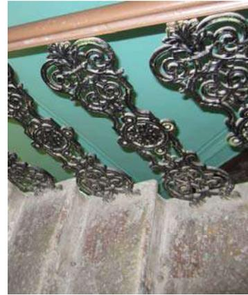
исторические служебные лестницы – конфигурация, габариты, местоположение, тип (двухмаршевые), конструкция (по косоурам, площадки по плоским перекрытиям и прусским сводам), вид материала ступеней (известняк);
