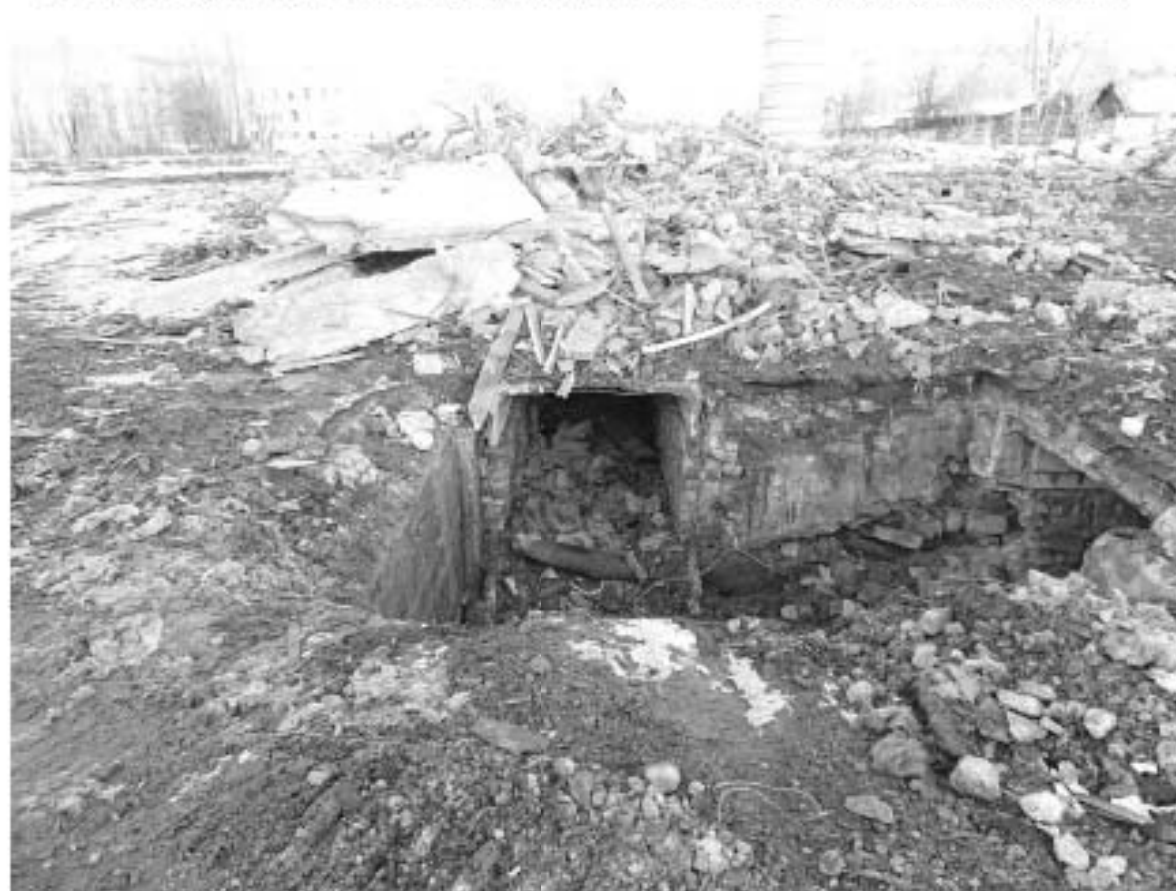
Точка фотофиксации 6. Остатки каналов теплотрассы после сноса здания. Вид с 3.
