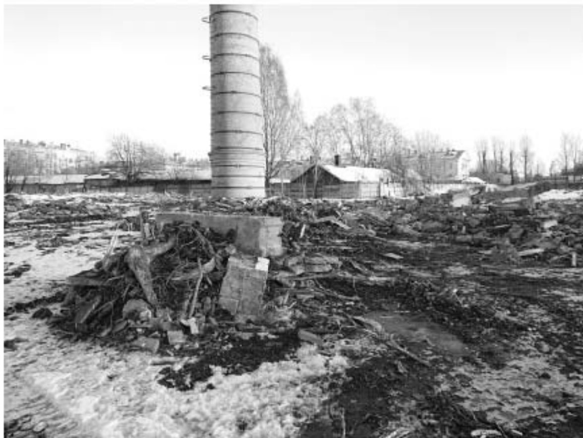
Точка фотофиксации 5. Остатки разломанных стен снесенного здания. Вид с 3.
