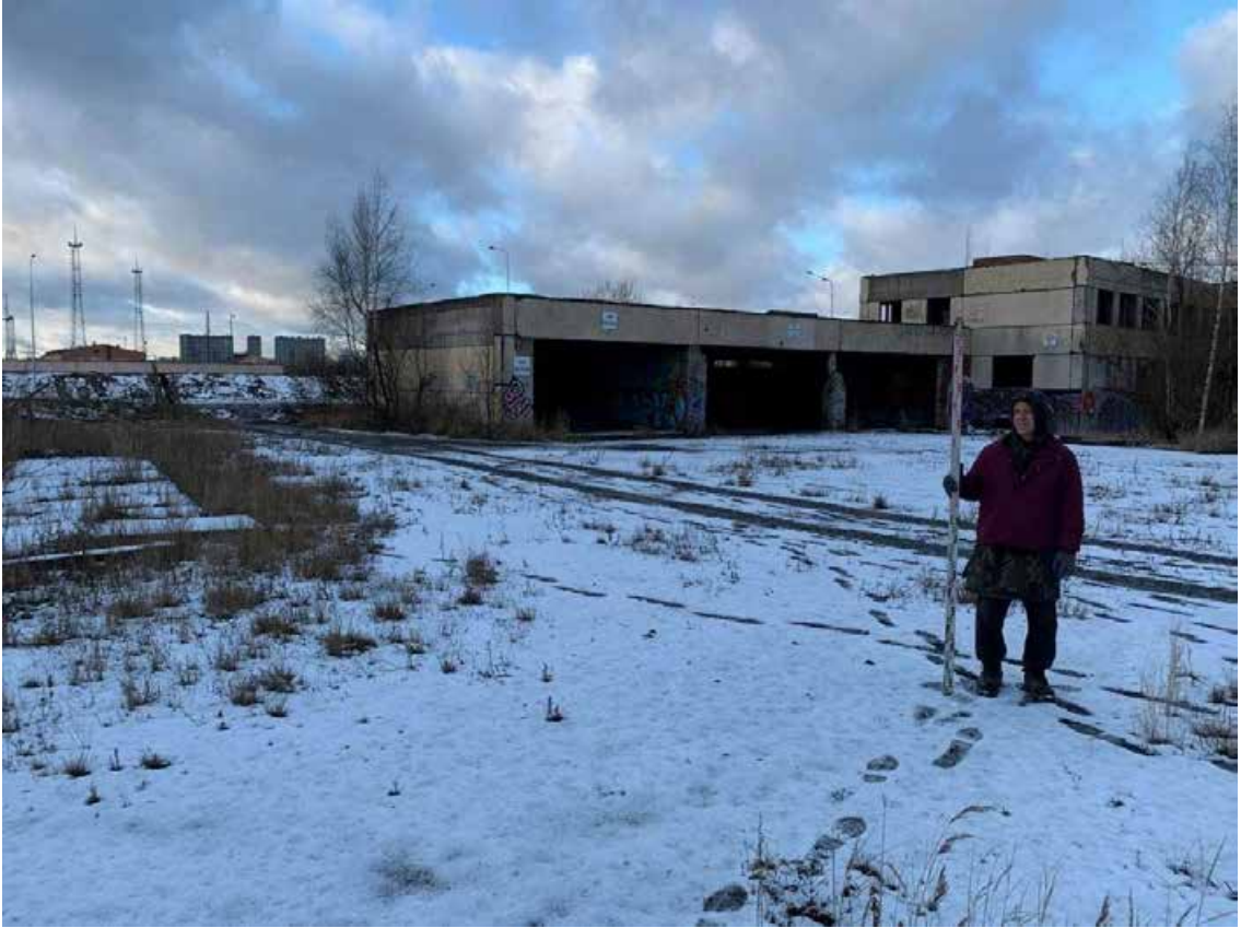
Рис. 43. Санкт-Петербург, Красногвардейский район. Точка съёмки 9. Общий вид участка обследования. Вид с СЗ.
