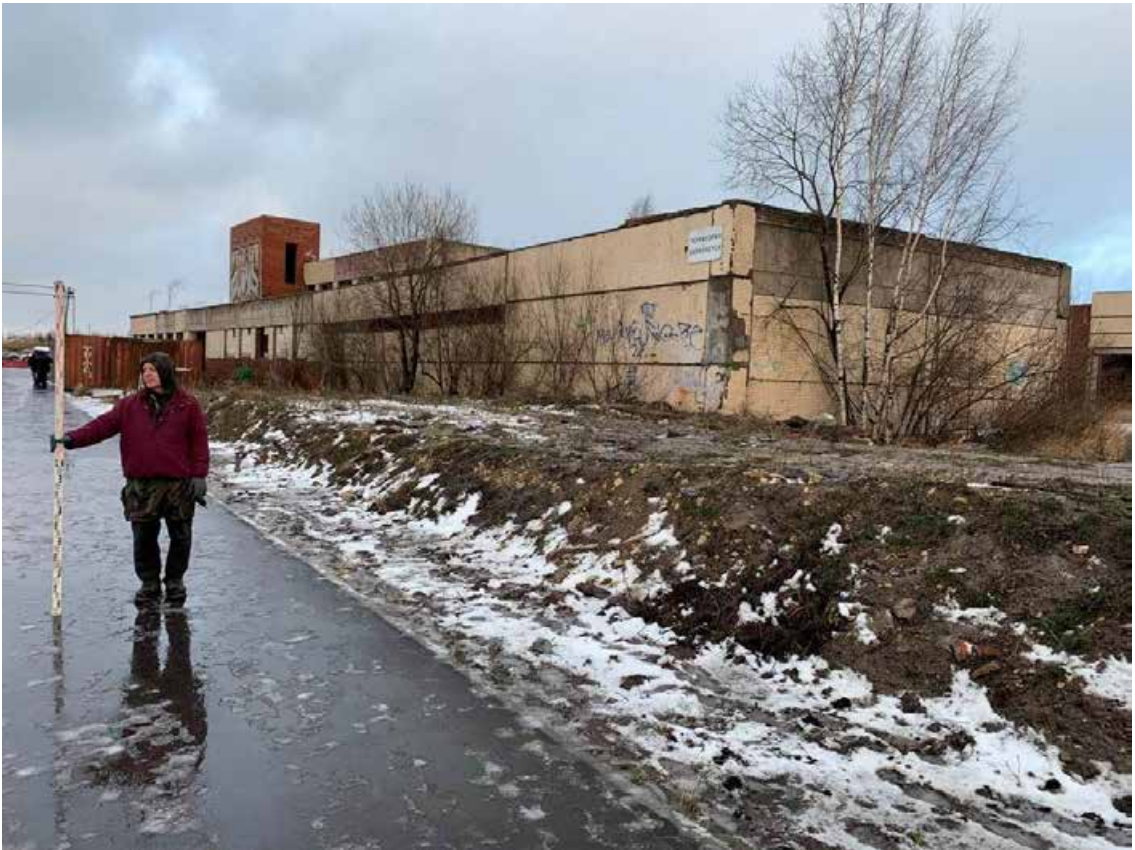
Рис. 81. Санкт-Петербург, Красногвардейский район. Точка съёмки 18. Общий вид участка обследования. Вид с ССВ.
