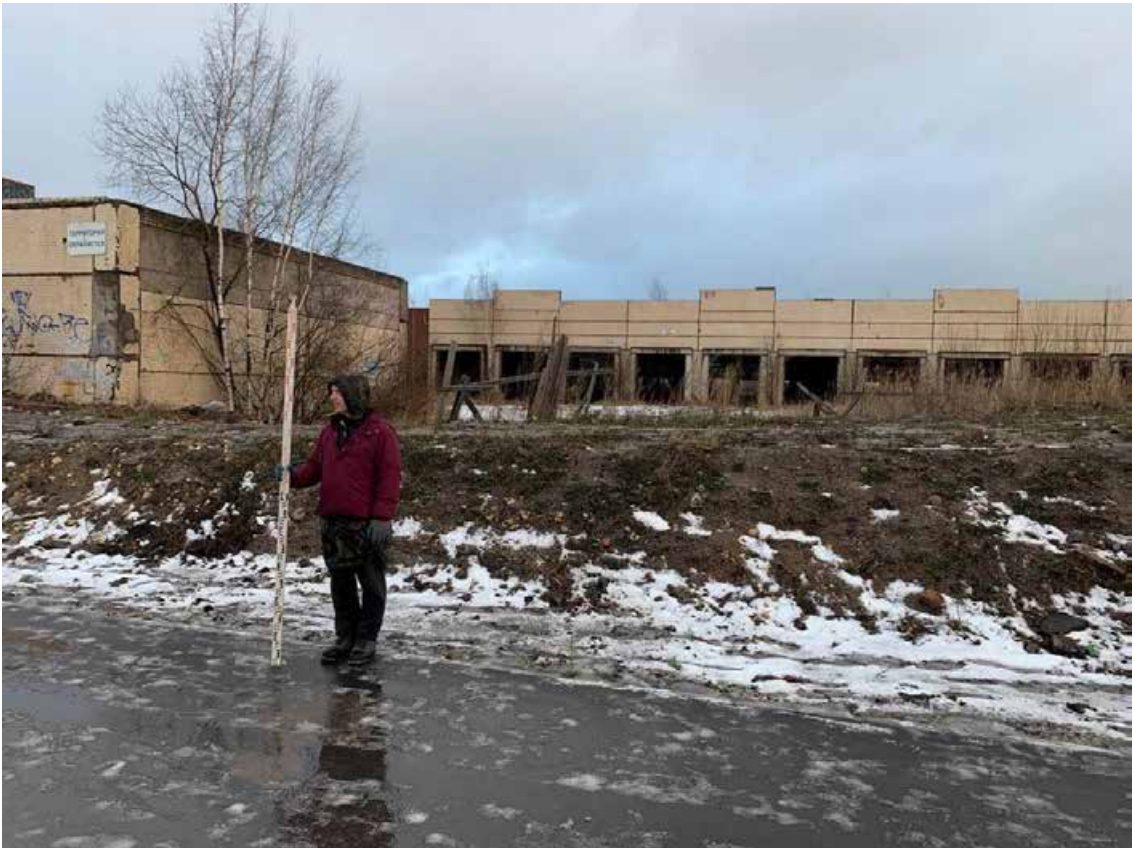
Рис. 82. Санкт-Петербург, Красногвардейский район. Точка съёмки 18. Общий вид участка обследования. Вид с СВ.
