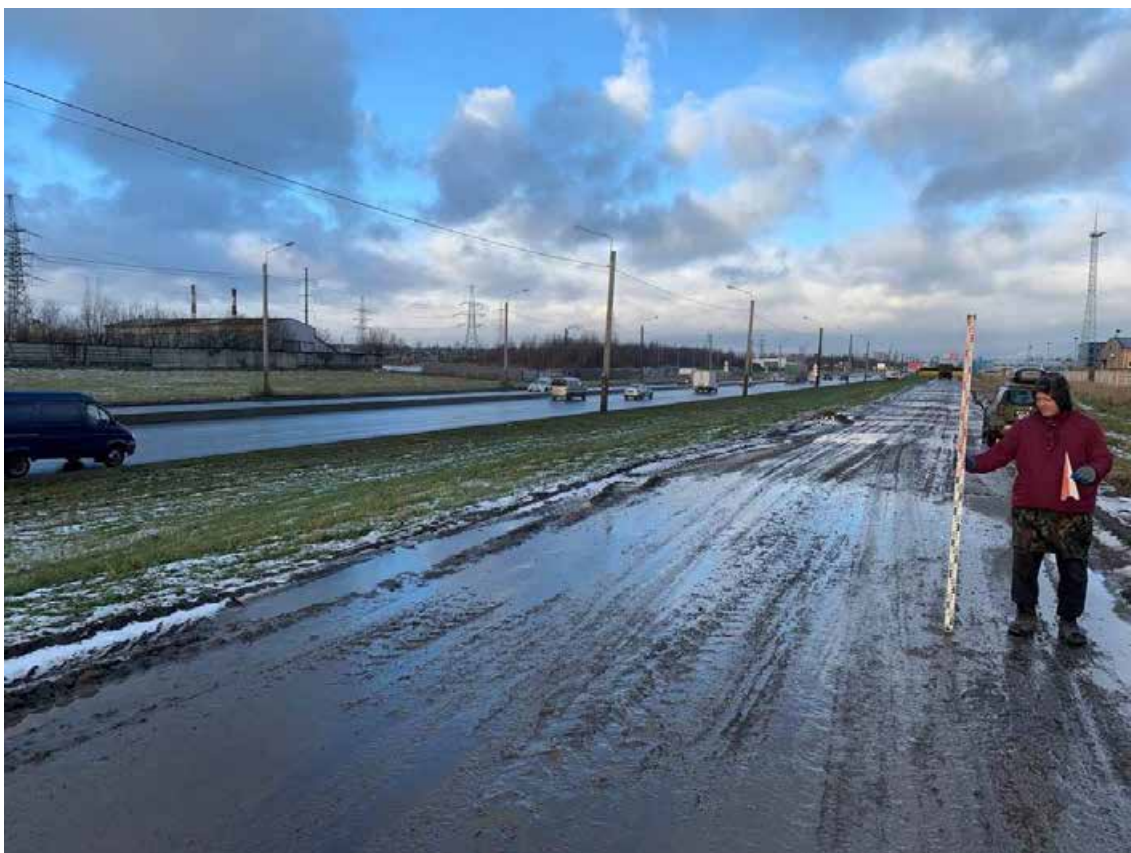
Рис. 16. Санкт-Петербург, Красногвардейский район. Точка съёмки 2. Общий вид участка обследования. Вид с ССЗ.
