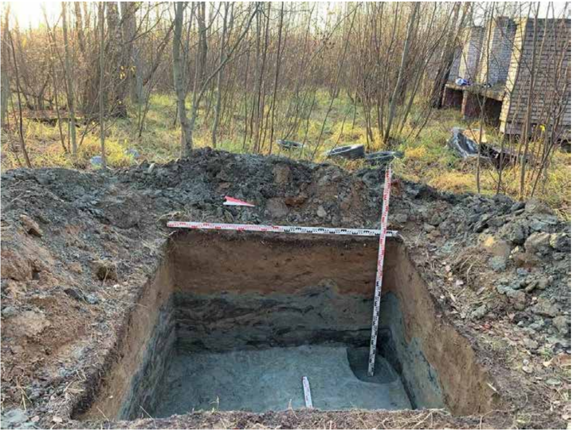
Рис. 107. Санкт-Петербург, Красногвардейский район. Общий вид Шурфа 2. Финальная зачистка. Вид с В.
