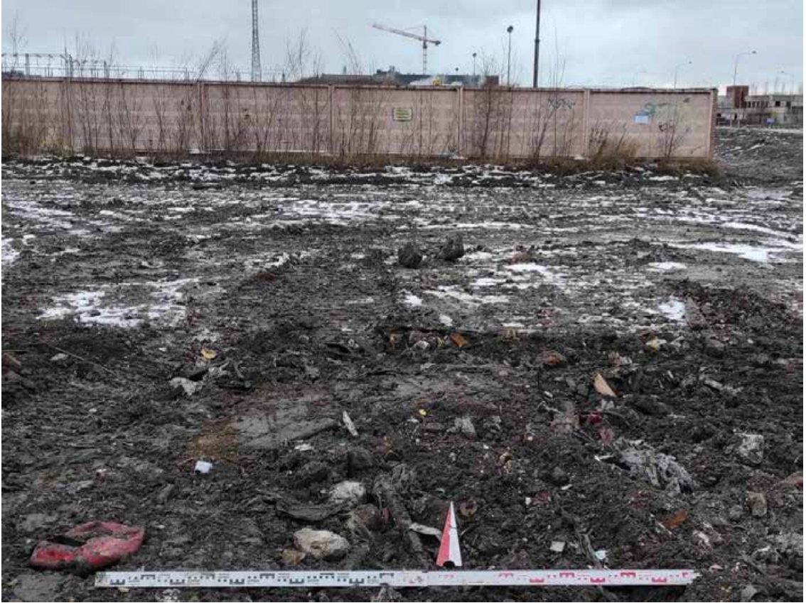
Рис. 117. Санкт-Петербург, Красногвардейский район. Шурф 4. Месторасположение Шурфа 4. После рекультивации. Вид с Ю.
