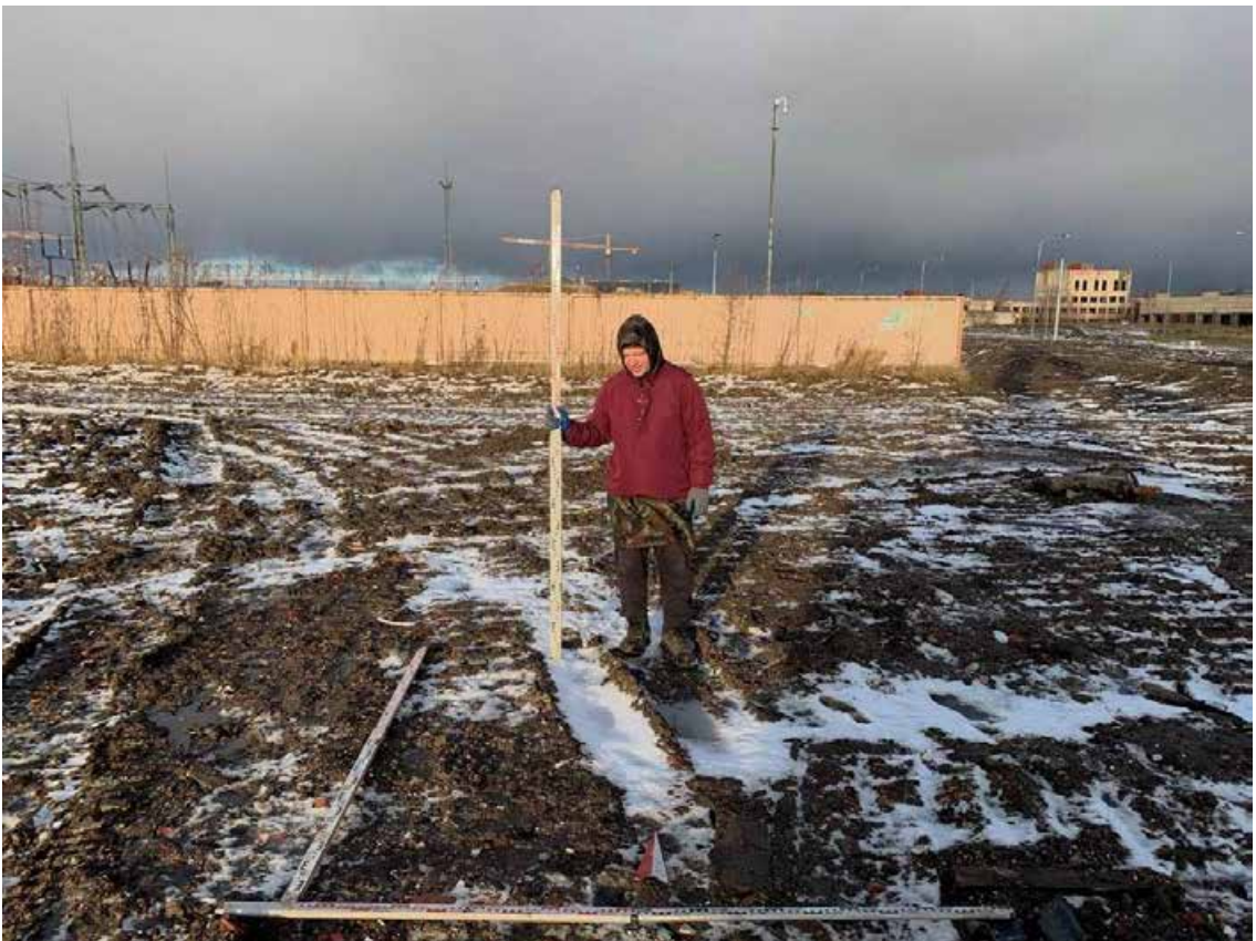
Рис. 114. Санкт-Петербург, Красногвардейский район. Месторасположение Шурфа 4. До начала работ. Вид с Ю.
