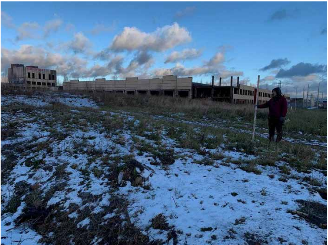
Рис. 38. Санкт-Петербург, Красногвардейский район. Точка съёмки 7. Общий вид участка обследования. Вид с СВ.
