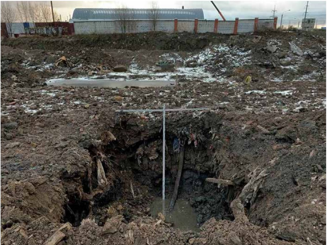
Рис. 111. Санкт-Петербург, Красногвардейский район. Общий вид Шурфа 3. Финальная зачистка. Вид с С.
