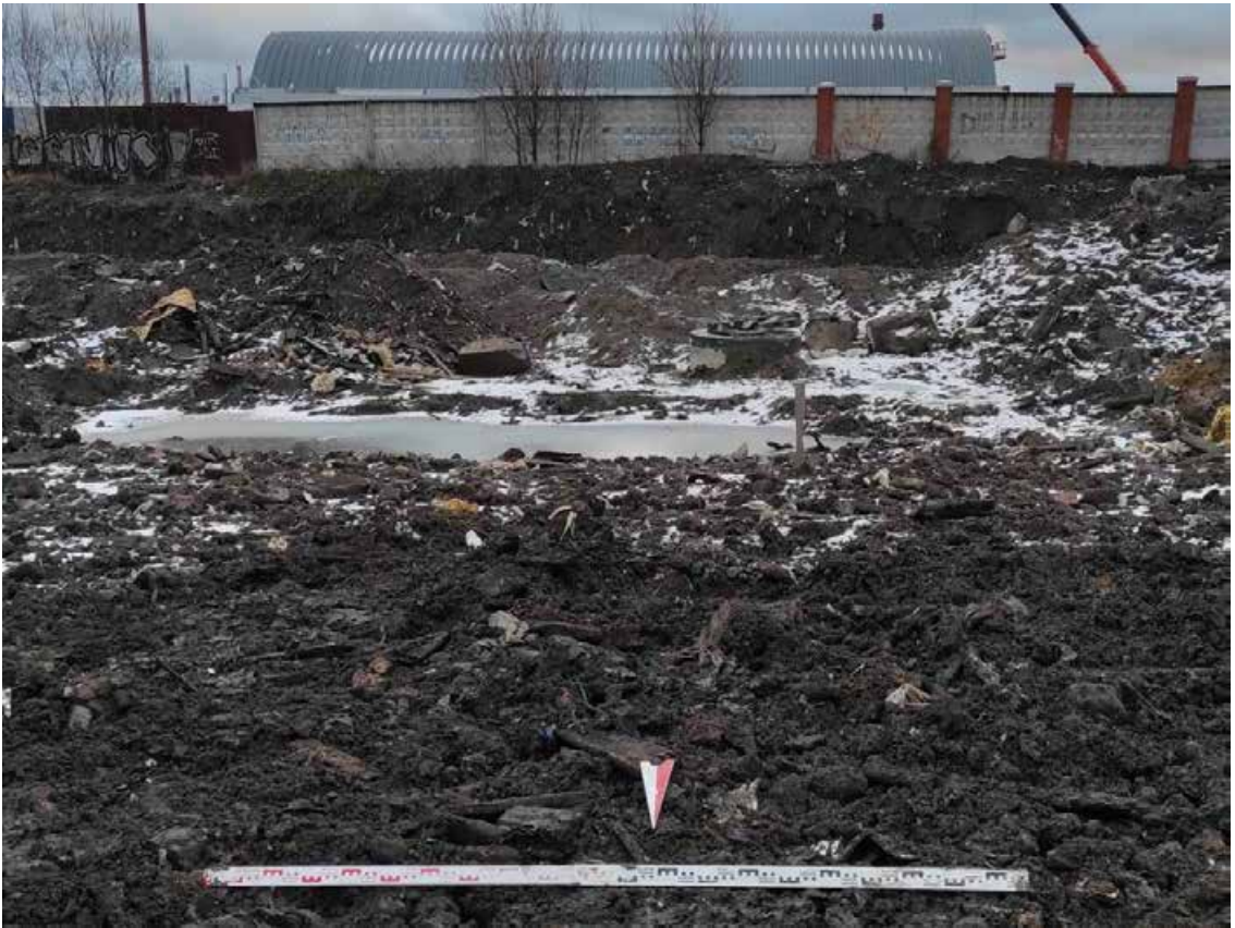
Рис. 113. Санкт-Петербург, Красногвардейский район. Шурф 3. Месторасположение Шурфа 3. После рекультивации. Вид с С.
