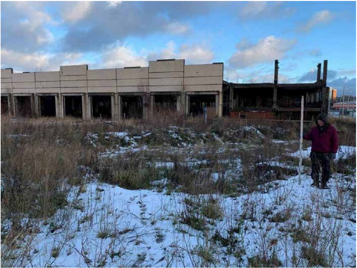
Рис. 41. Санкт-Петербург, Красногвардейский район. Точка съёмки 8. Общий вид участка обследования. Вид с В.
