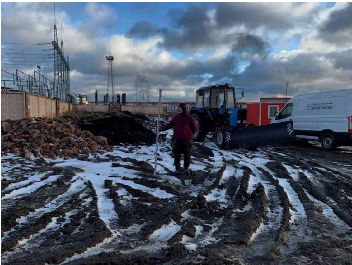
Рис. 18. Санкт-Петербург, Красногвардейский район. Точка съёмки 2. Общий вид участка обследования. Вид с В.
