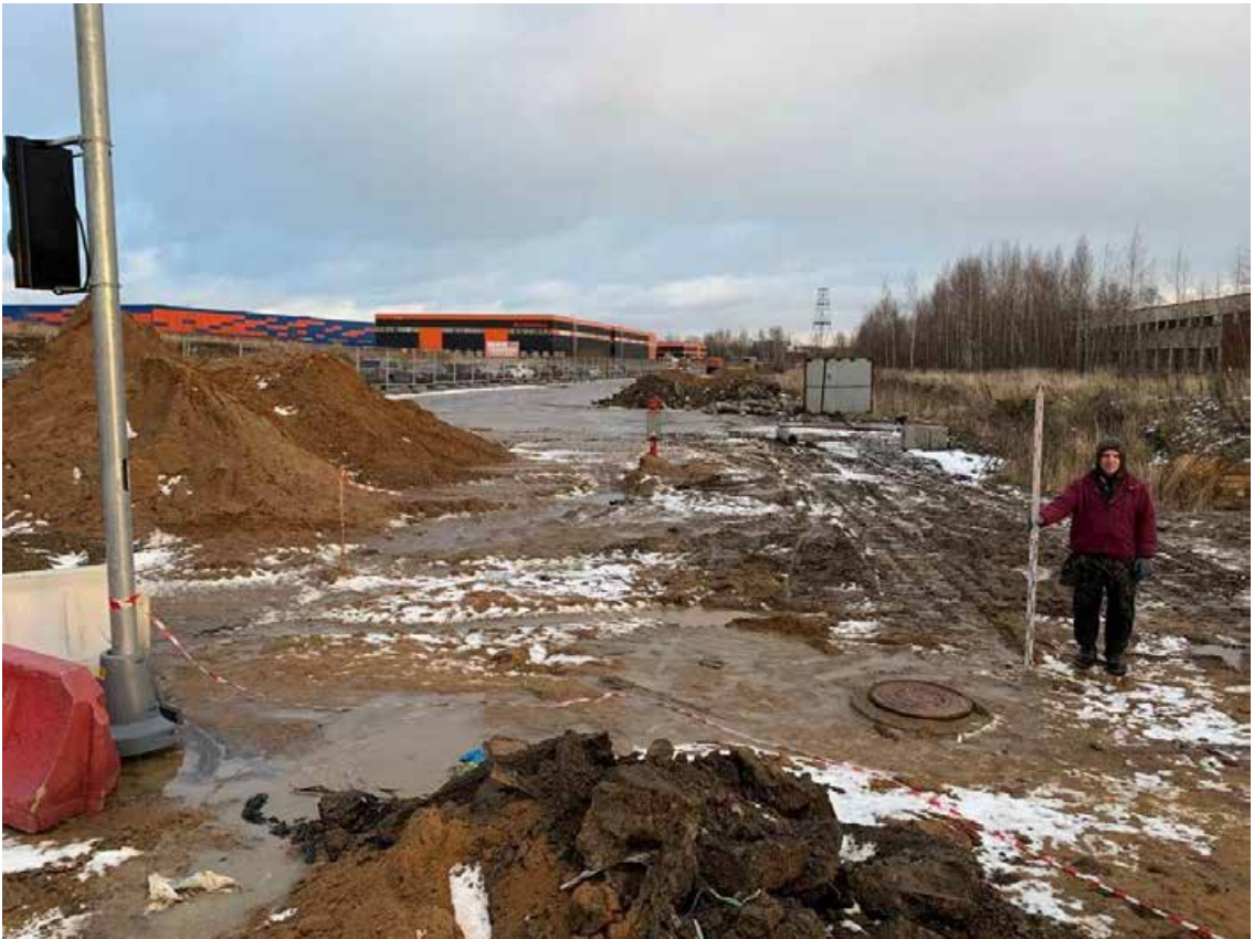
Рис. 77. Санкт-Петербург, Красногвардейский район. Точка съёмки 17. Общий вид участка обследования. Вид с В.
