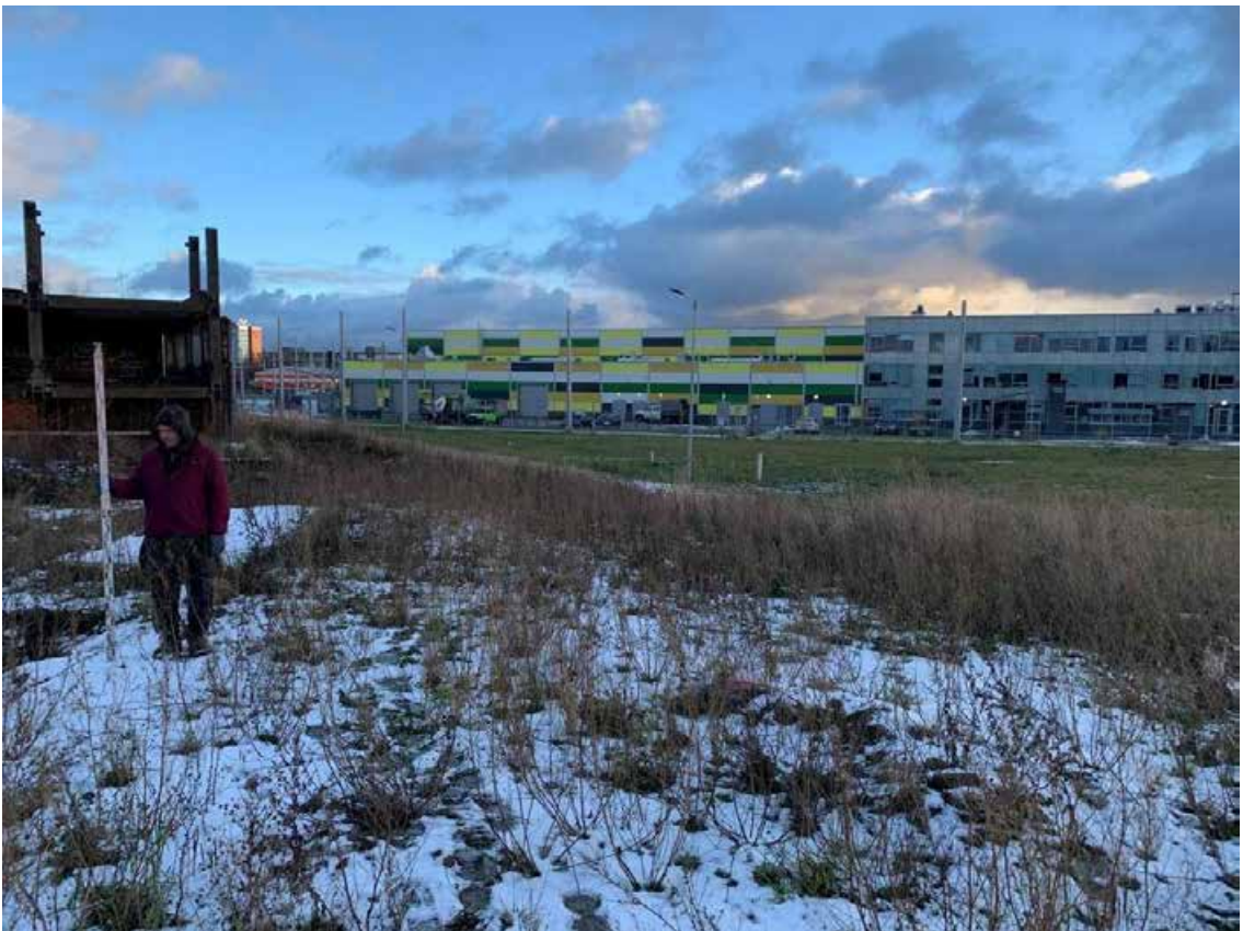
Рис. 40. Санкт-Петербург, Красногвардейский район. Точка съёмки 8. Общий вид участка обследования. Вид с ВЮВ.
