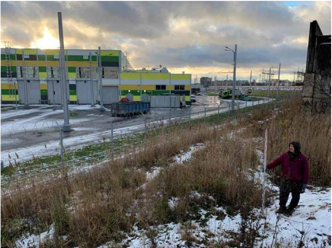
Рис. 50. Санкт-Петербург, Красногвардейский район. Точка съёмки 11. Общий вид участка обследования. Вид с ЮЗ.
