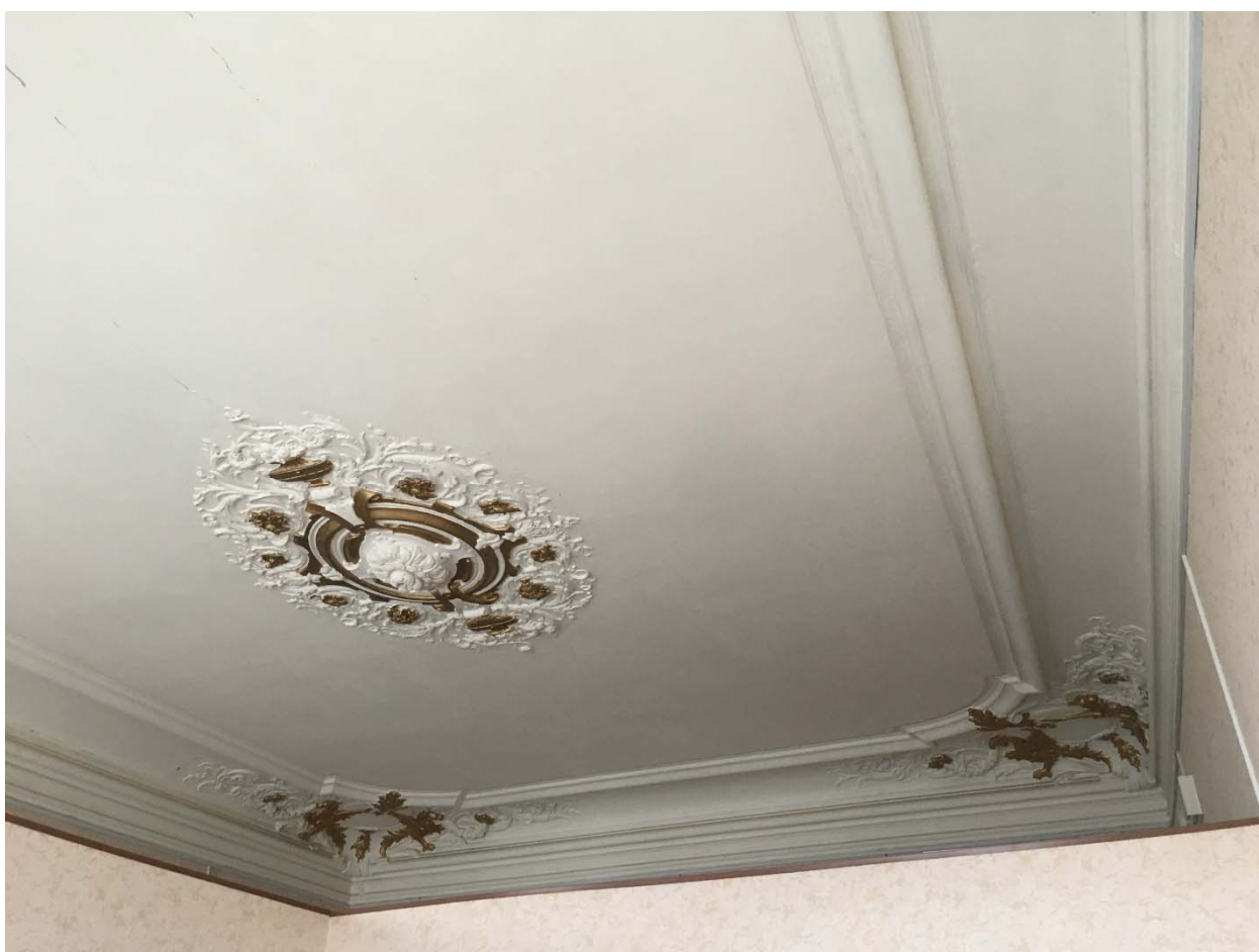
Фото №21. Помещение №12, отделка потолка, определенная как предмет охраны.
