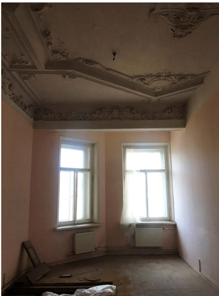
Фото №7. Часть помещения №4. Отделка потолка, определенная как предмет охраны.
