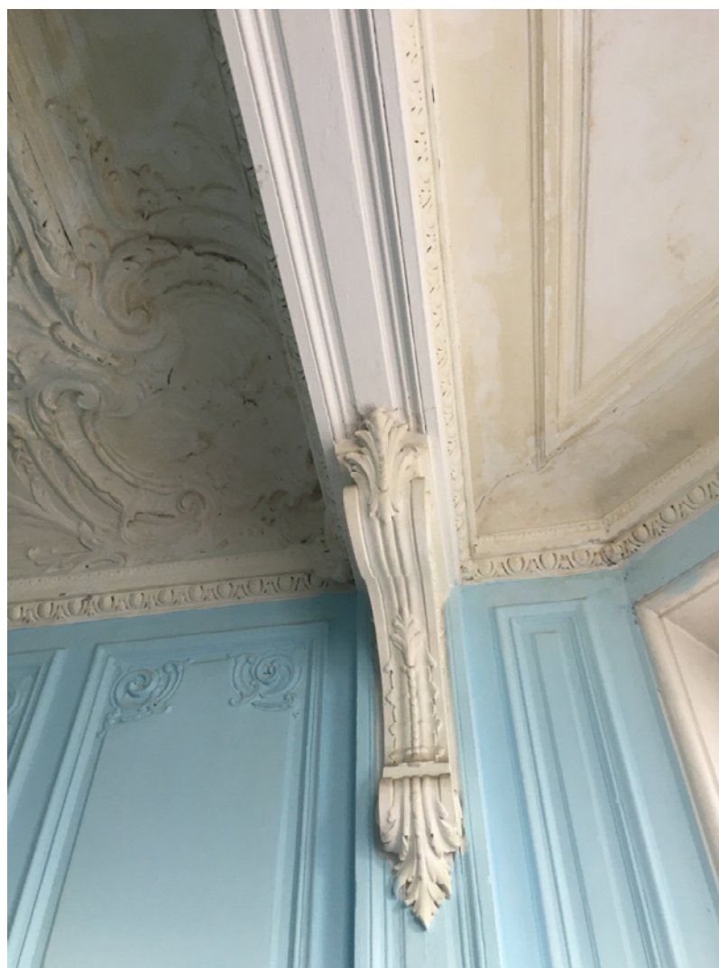
Фото №29. Помещение №18, отделка потолка, определенная как предмет охраны.
