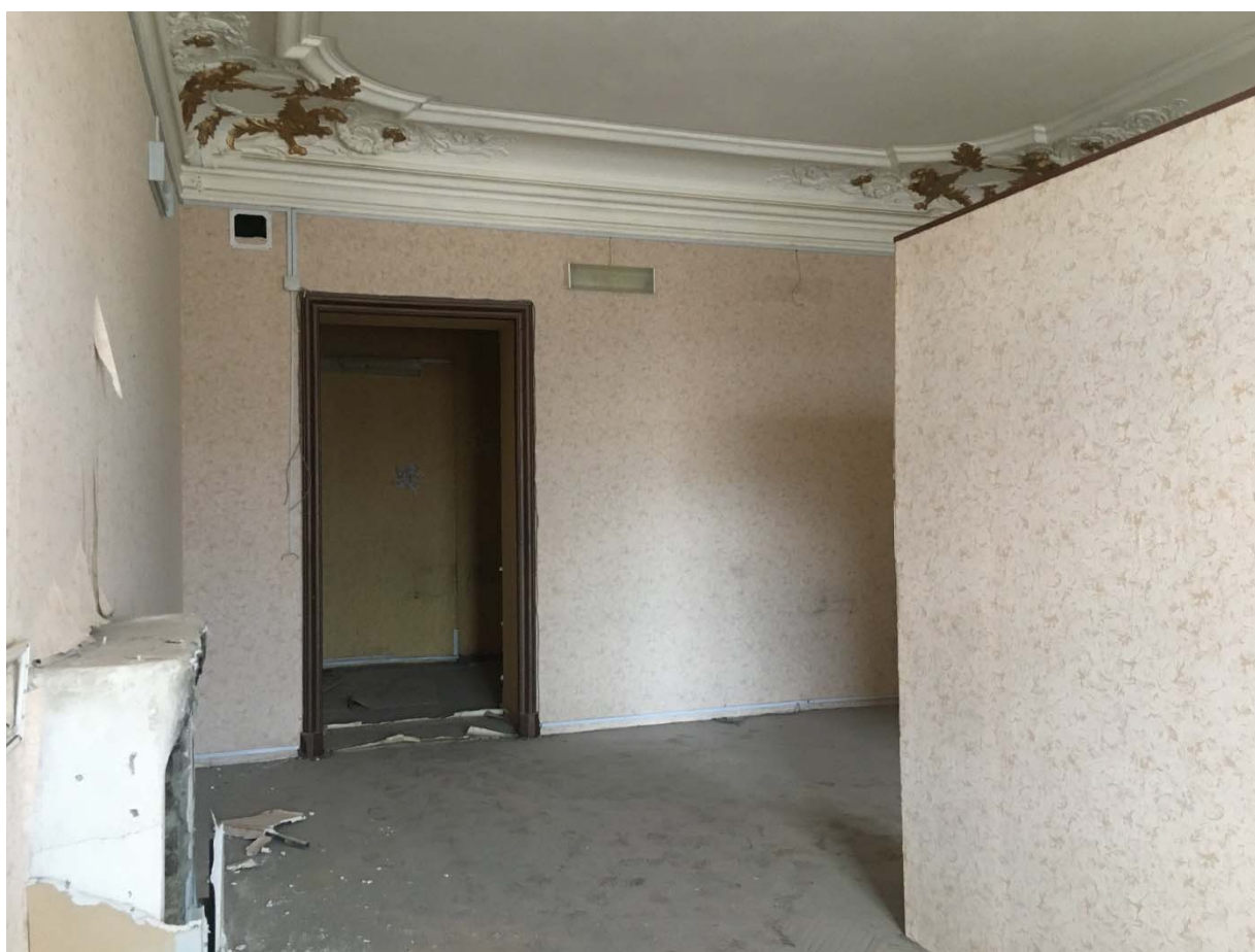
Фото №22. Помещение №12, отделка потолка, определенная как предмет охраны.
