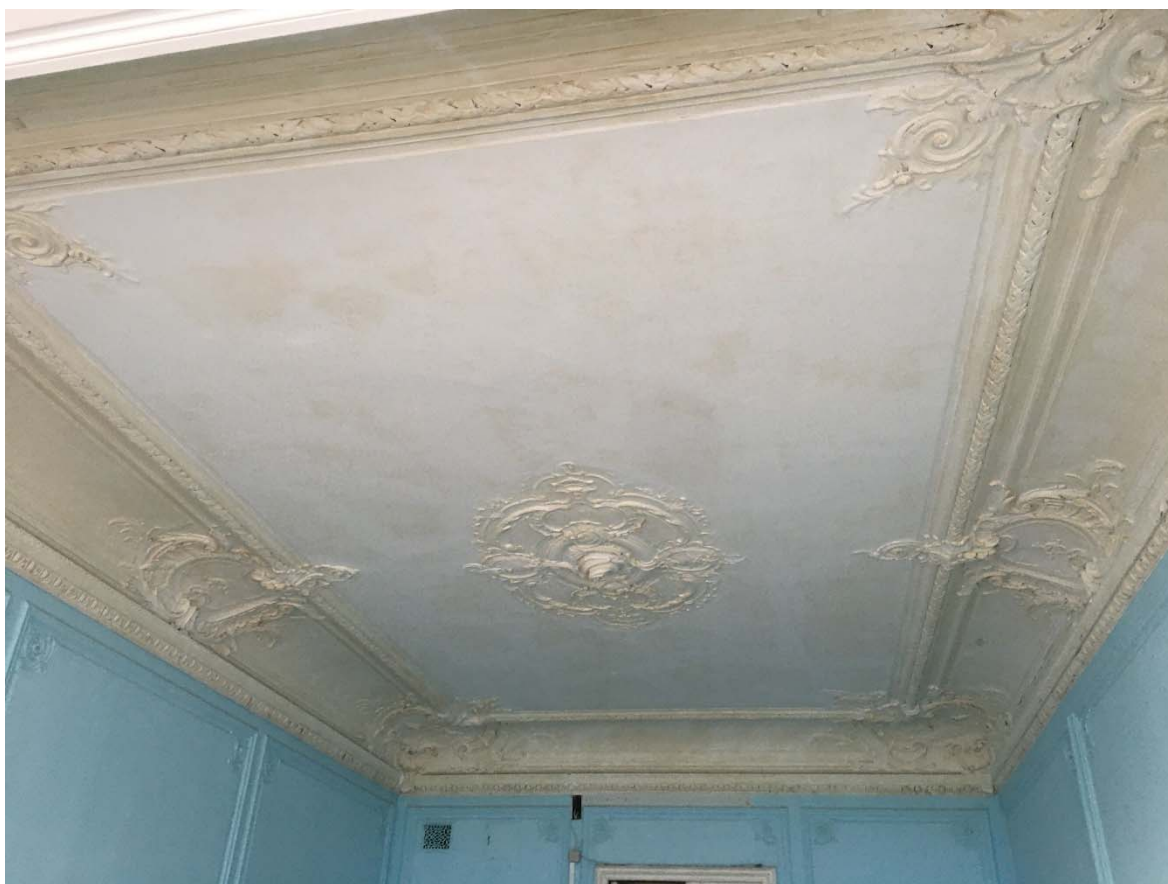
Фото №28. Помещение №18, отделка потолка, определенная как предмет охраны.
