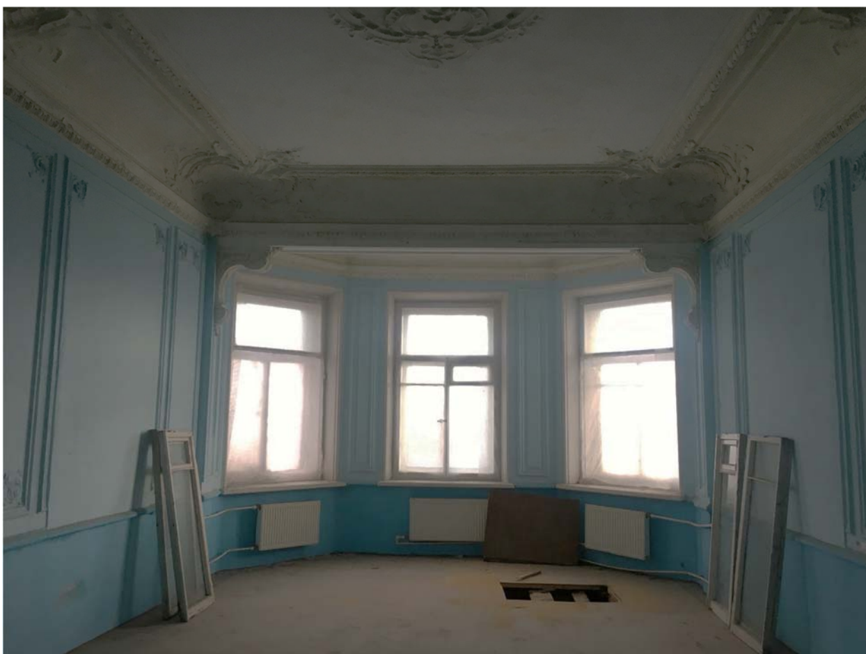
Фото №25. Помещение №18, отделка стен и потолка, определенная как предмет охраны.
