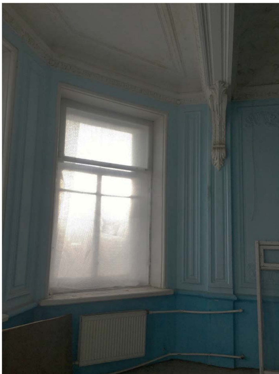
Фото №26. Помещение №18, отделка стен и потолка, определенная как предмет охраны.
