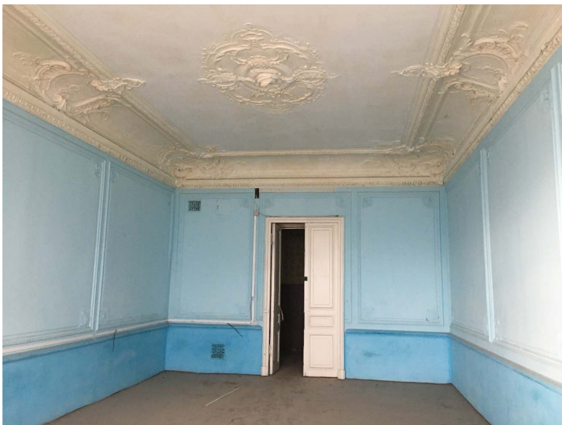
Фото №27. Помещение №18, отделка стен и потолка, определенная как предмет охраны.
