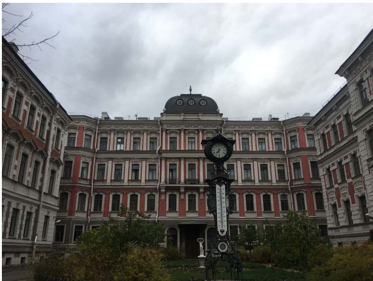
Фото №1. Лицевой фасад здания, обращенный в курдонер.
