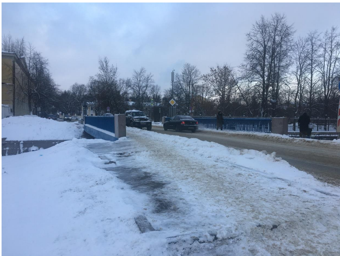
6. Общий вид на объект культурного наследия регионального значения «Синий мост через Обводный канал» по адресу г. Кронштадт, Макаровская улица. Направление съемки северо-запад.
