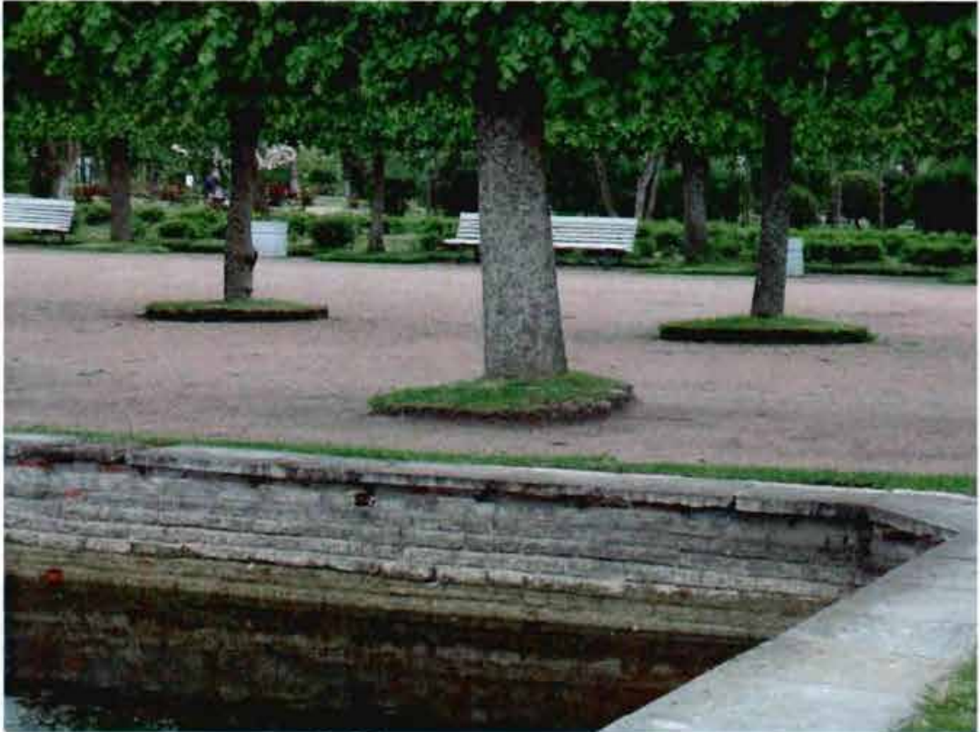
3. Облицовка подпорных стен
