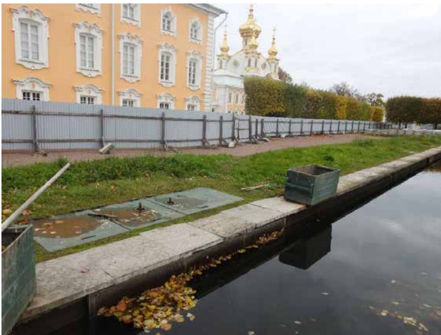
18. «Пруд восточный квадратный с фонтаном» в составе объекта «Верхний сад», входящего в состав ансамбля «Дворцово-парковый ансамбль Петродворца», г. Петергоф, ул. Разводная, д.2 (северо-восточная часть Верхнего сада). Общий вид северной подпорной стенки пруда с водозаборными камерами. Фото 22.09.2021г.
