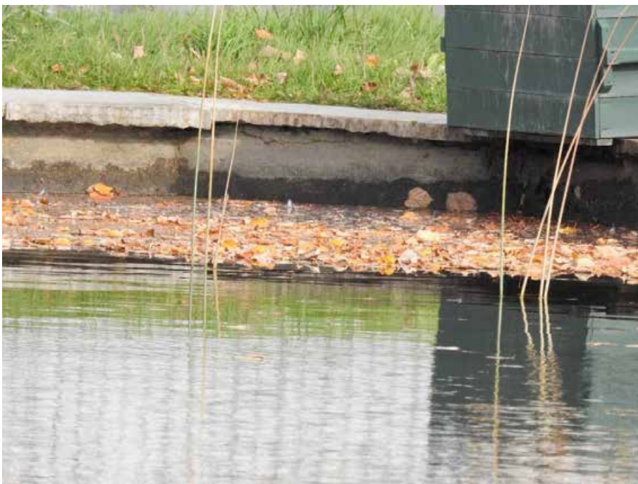
12. «Пруд восточный квадратный с фонтаном» в составе объекта «Верхний сад», входящего в состав ансамбля «Дворцово-парковый ансамбль Петродворца», г. Петергоф, ул. Разводная, д.2 (северо-восточная часть Верхнего сада). Стык северной бетонной стенки пруда и восточной кирпичной стенки пруда. Фото 22.09.2021г.
