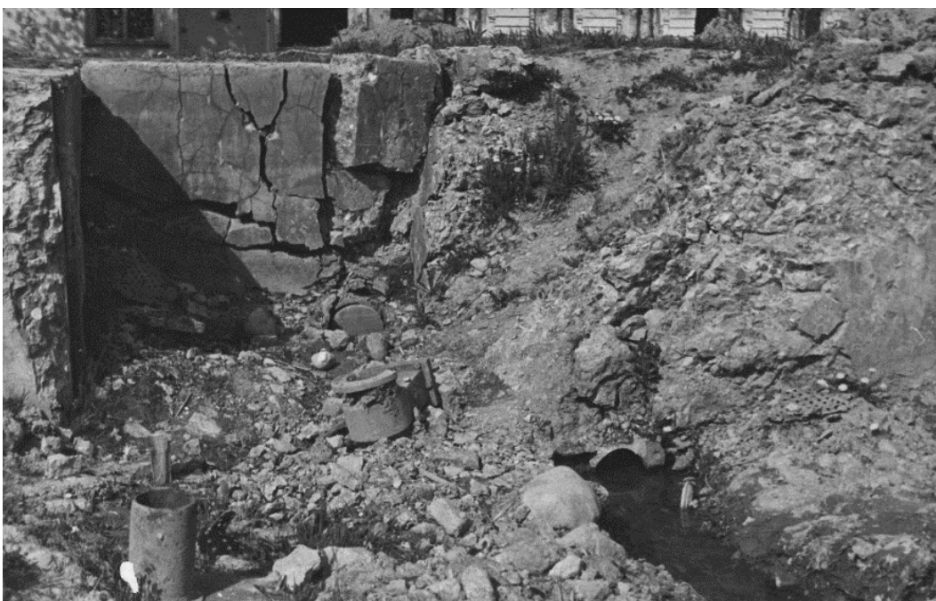
27. Разрушения конструкций камеры затворов № 4в и донного слива № 4б. 1944 г. (Архив ГМЗ «Петергоф». ПДМП 9226-фд).
