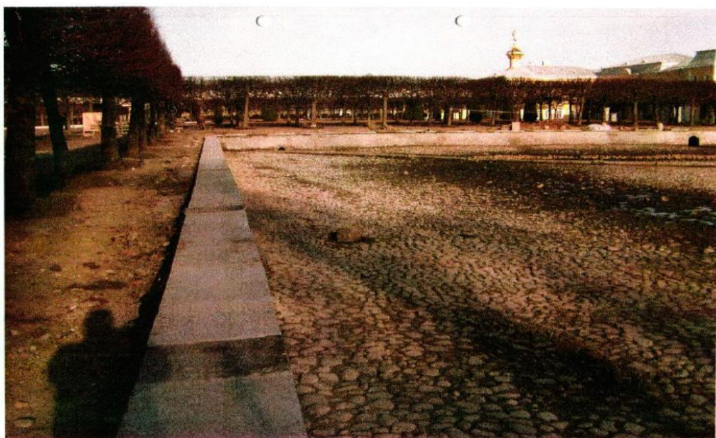
41. Петергоф. Верхний сад. Восточный Квадратный пруд. 2009 г. Состояние южной подпорной стенки и дна пруда после завершения противоаварийных работ. (Научный отчёт о проделанной работе», ООО «Феррумленд» 2009 г.). Архив Службы реставрации, реконструкции и капитального ремонта ГМЗ «Петергоф».
