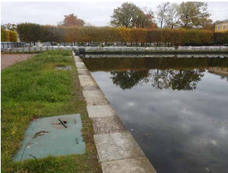
19. «Пруд восточный квадратный с фонтаном» в составе объекта «Верхний сад», входящего в состав ансамбля «Дворцово-парковый ансамбль Петродворца», г. Петергоф, ул. Разводная, д.2 (северо-восточная часть Верхнего сада). Вид кордонных плит и водозаборных камер северной подпорной стенки пруда. Фото 22.09.2021г.
