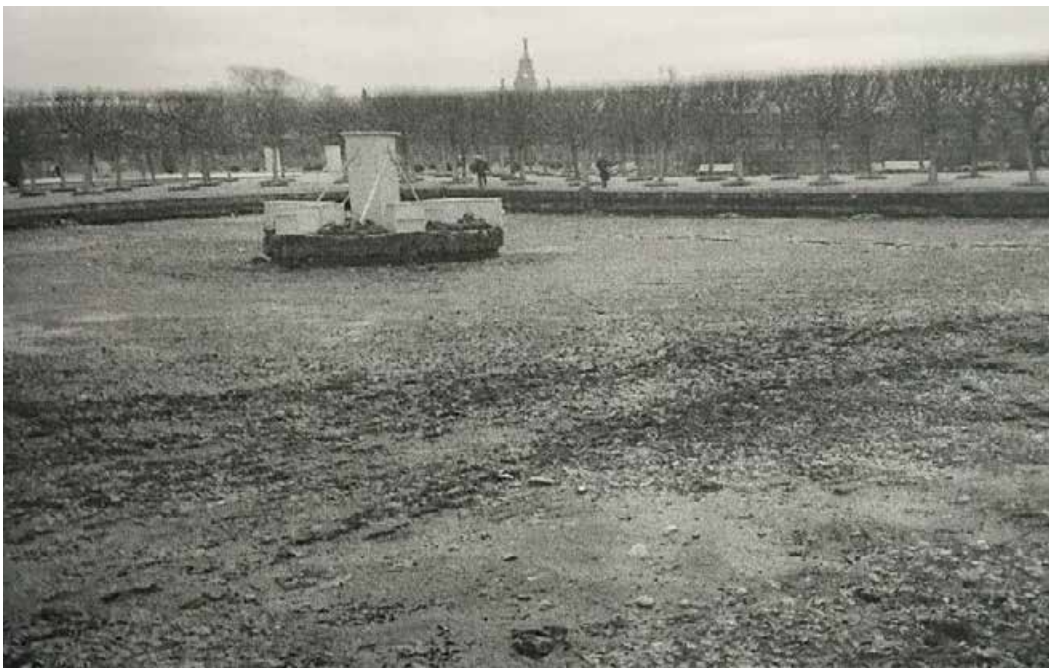
38. Петергоф. Верхний сад. Восточный Квадратный пруд. 2009 г. Состояние дна до начала противоаварийных работ (Научный отчёт о проделанной работе», ООО «Феррумленд» 2009 г.). Архив Службы реставрации, реконструкции и капитального ремонта ГМЗ «Петергоф».
