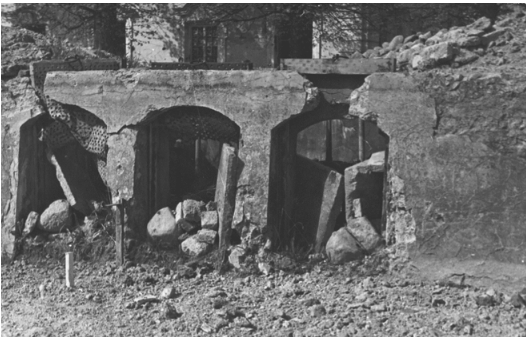
26. Разрушения конструкций средней камеры затворов (№ 5в). 1944 г. (Архив ГМЗ «Петергоф». ПДМП 9224-фд).
