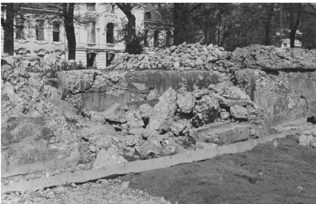
25. Разрушения конструкций восточной камеры затворов (№ 6в). 1944 г. (Архив ГМЗ «Петергоф». ПДМП 9222-фд).
