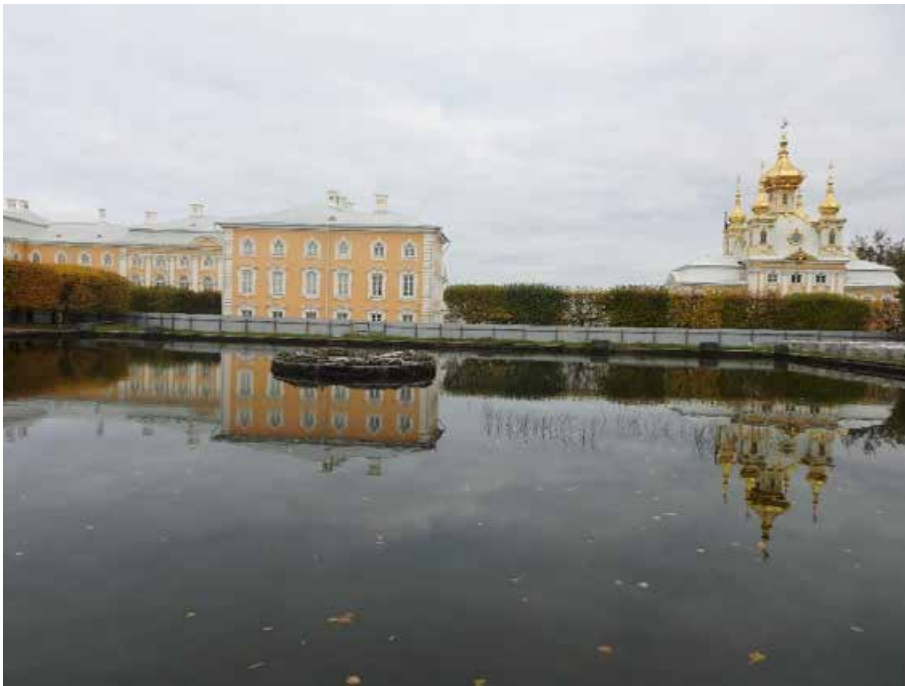
3. «Пруд восточный квадратный с фонтаном» в составе объекта «Верхний сад», входящего в состав ансамбля «Дворцово-парковый ансамбль Петродворца», г. Петергоф, ул. Разводная, д.2 (северо-восточная часть Верхнего сада). Общий вид с южного берега пруда. Фото 22.09.2021г.
