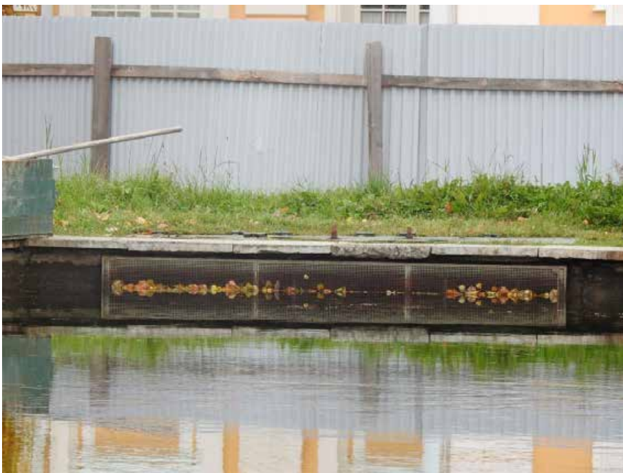
20. «Пруд восточный квадратный с фонтаном» в составе объекта «Верхний сад», входящего в состав ансамбля «Дворцово-парковый ансамбль Петродворца», г. Петергоф, ул. Разводная, д.2 (северо-восточная часть Верхнего сада). Фрагмент северной подпорной стенки. Фото 22.09.2021г.
