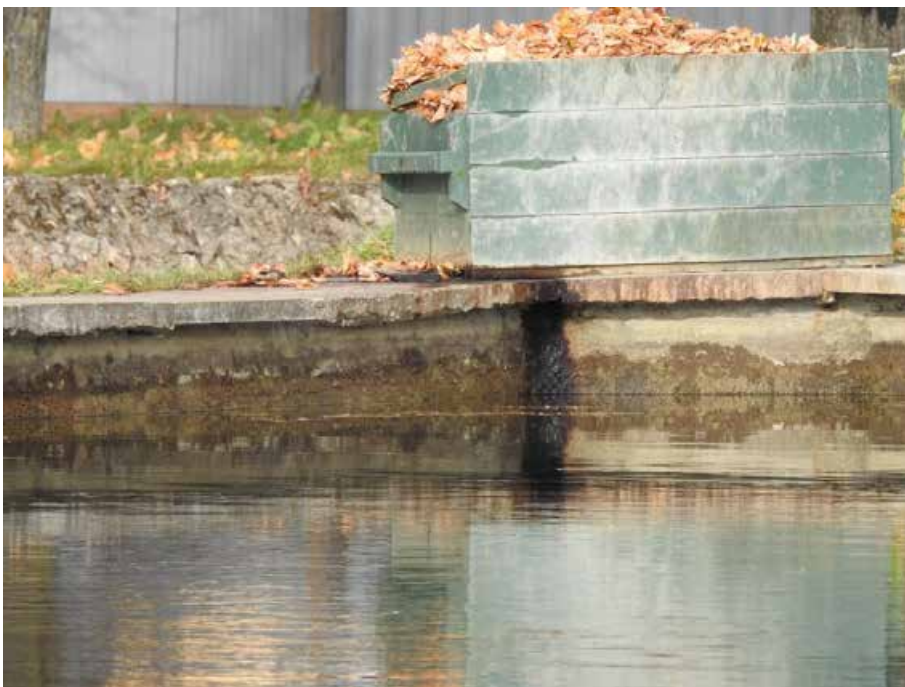
8. «Пруд восточный квадратный с фонтаном» в составе объекта «Верхний сад», входящего в состав ансамбля «Дворцово-парковый ансамбль Петродворца», г. Петергоф, ул. Разводная, д.2 (северо-восточная часть Верхнего сада). Фрагмент западной части пруда. Фото 22.09.2021г.
