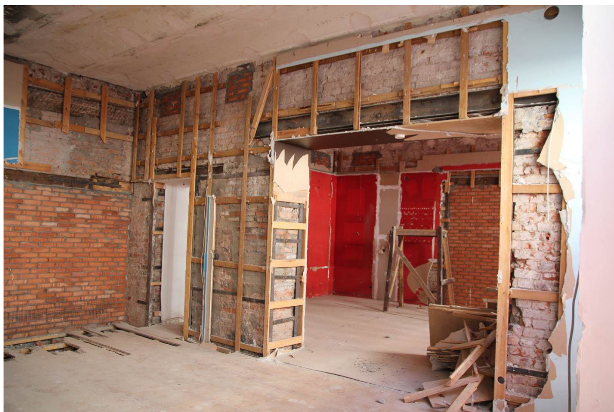
Фото №21. Общій вид помещения 11-Н (16). Вид на помещение 11-Н (15)
