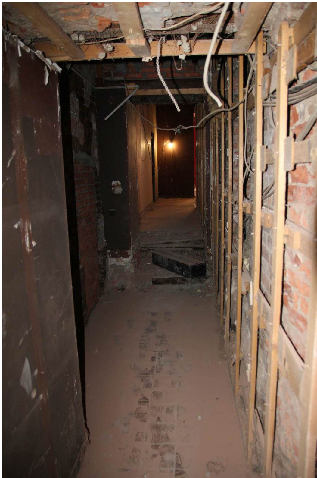
Фото №10. Общий вид помещения 11-Н (13)
