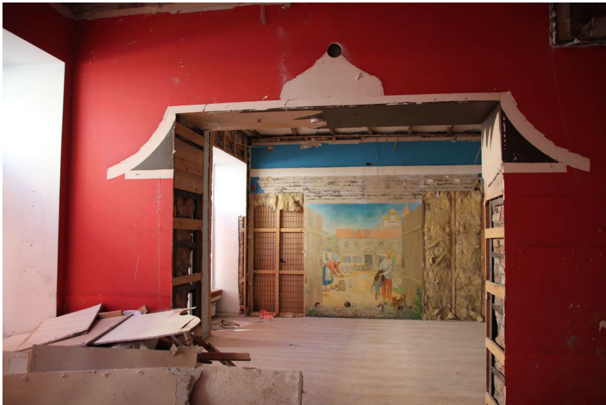
Фото №18. Вид на помещение 11-Н (16)
