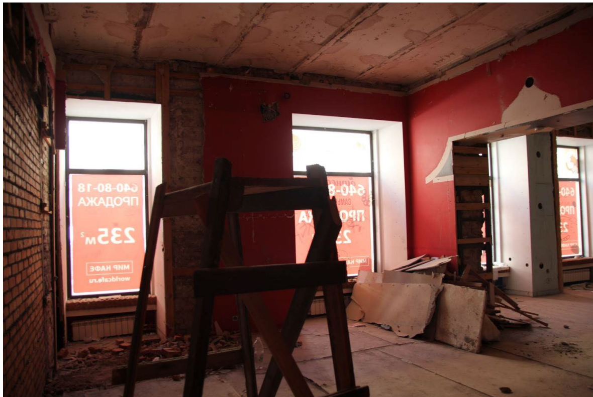
Фото №14. Общий вид помещения 11-Н (15)
