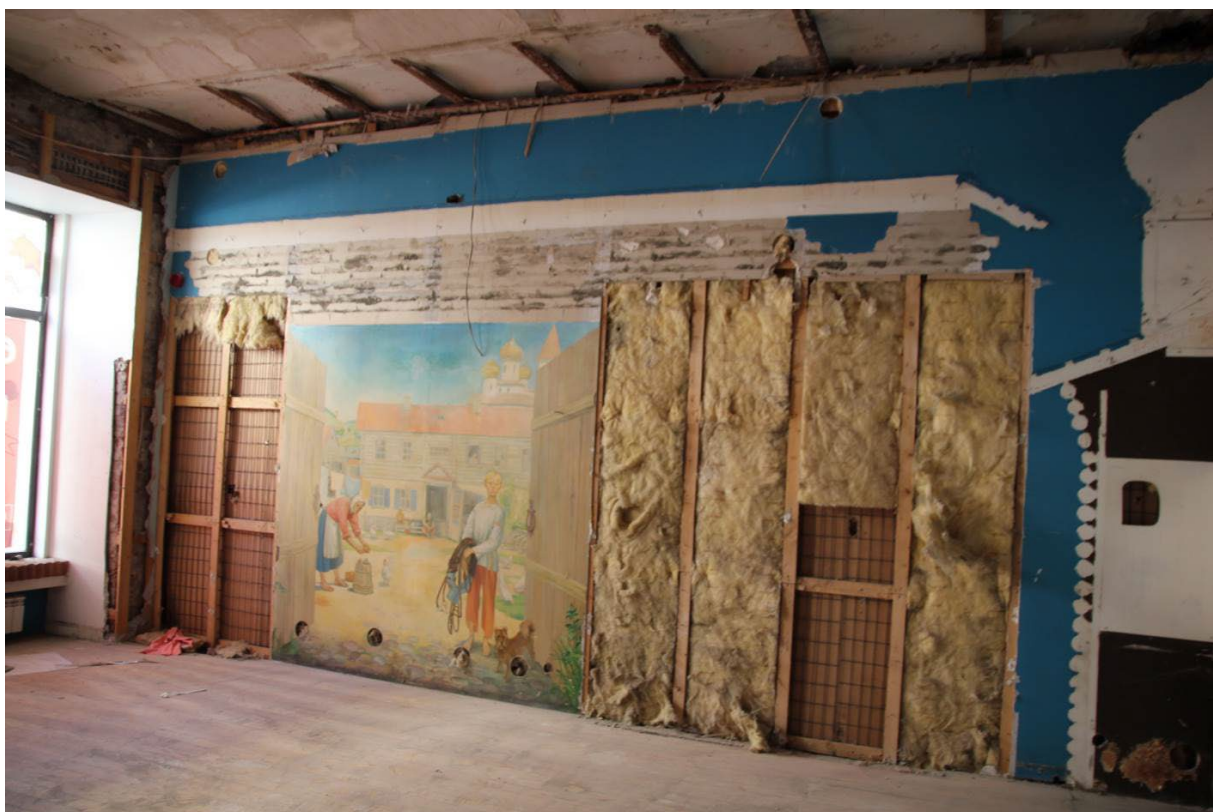
Фото №19. Общий вид помещения 11-Н (16)
