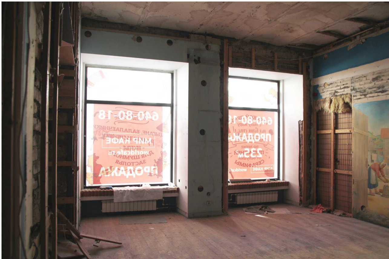
Фото №22. Общий вид помещения 11-Н (16)
