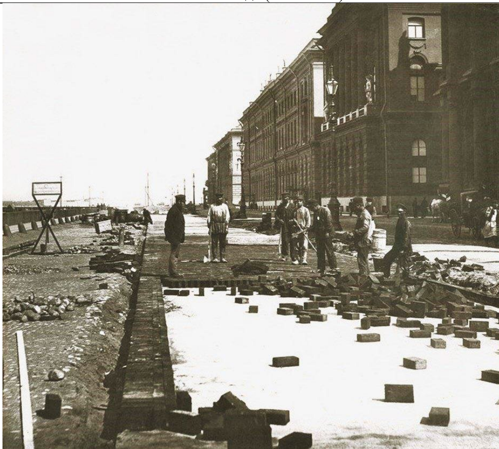
11. Начало 1900-х. Укладка торцовых шашек перед Зимним дворцом. ЦГ АКФФД. Д 9252
