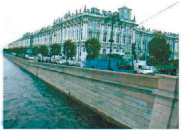
16. Вид стенки набережной с Дворцового моста
