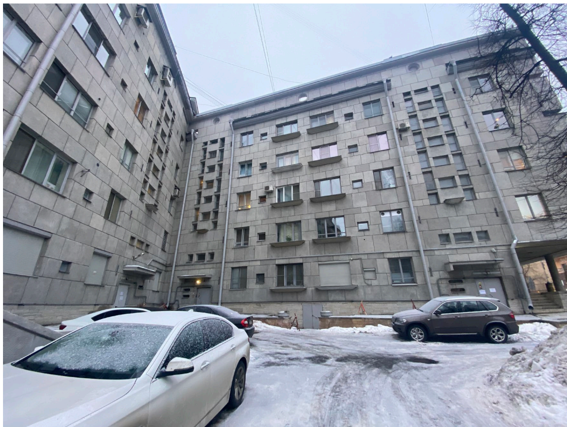
3. Вид на дворовой фасад
