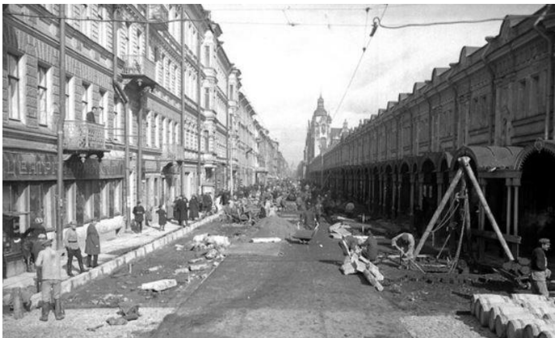
Илл. 23. Фото 1920-е гг. Дорожные работы на пр. Майорова (Вознесенском пр.) Укладка поребрика. Размещено на Retro View of Mankind's Habitat [Электронный ресурс]. Режим доступа: https://pastvu.com/ .
