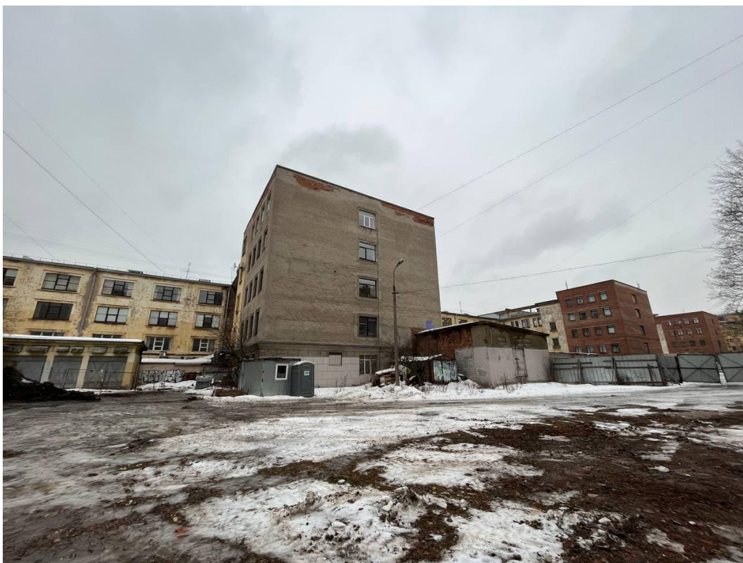
Фото 14. Участок производства работ.
