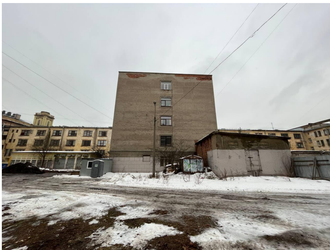
Фото 13. Участок производства работ.
