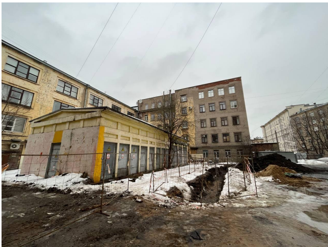
Фото 16. Участок производства работ.
