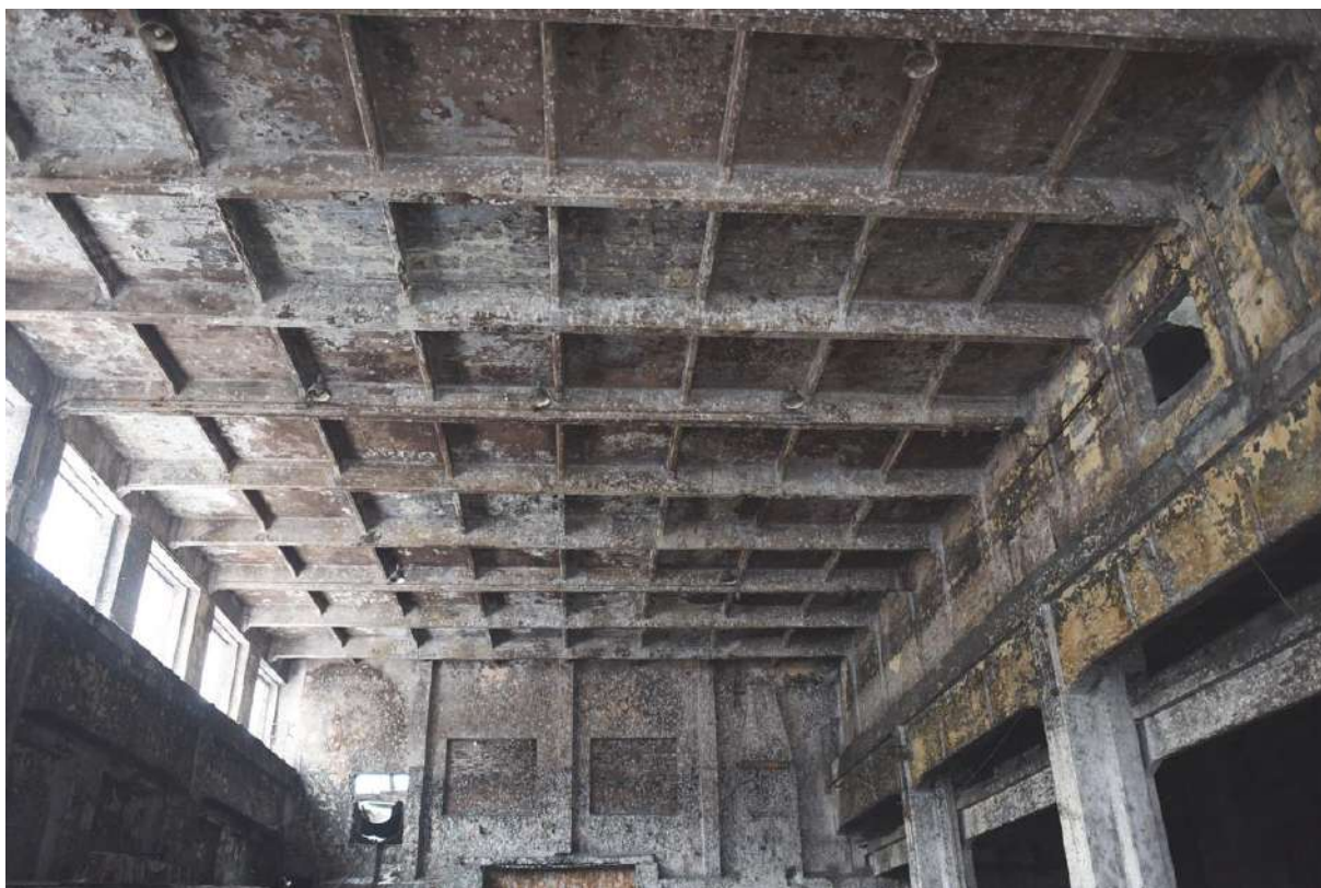
44. Выявленный объект культурного наследия «Чугунолитейный цех». Интерьер. Конструкции покрытия демонтируемой части здания.
