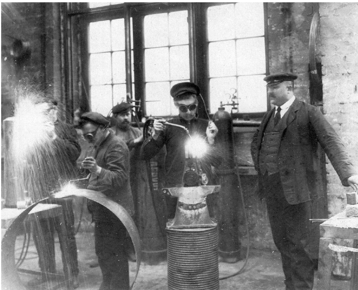
Илл. 31. Сварщики за работой в цехе чугунолитейного и машиностроительного завода «Людвиг Нобель». Фотография ателье Буллы. 1916 г. ЦГАКФФД СПб. Шифр: Е 2653.
