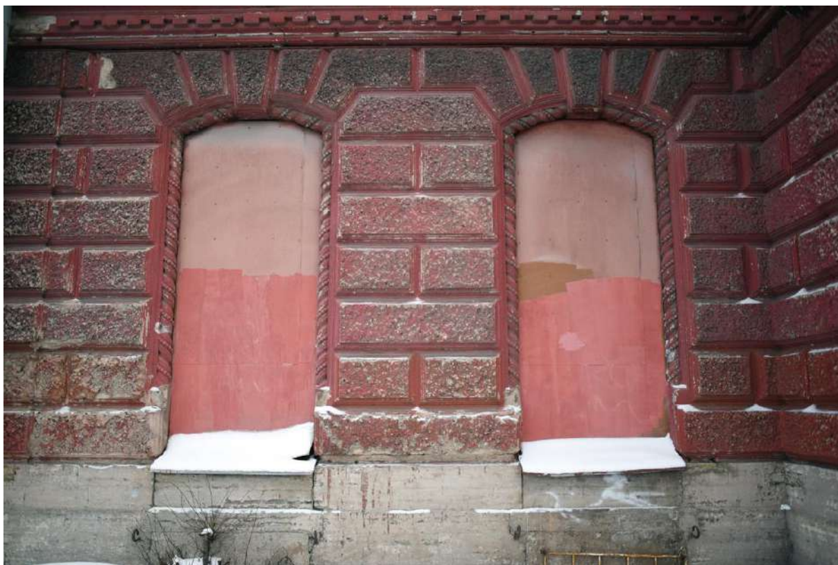
89. Объект культурного наследия федерального значения «Особняк и заводоуправление Механического завода «Людвиг Нобель» с зимним садом». Фрагмент главного (западного) фасада. Окна 1-го этажа.
