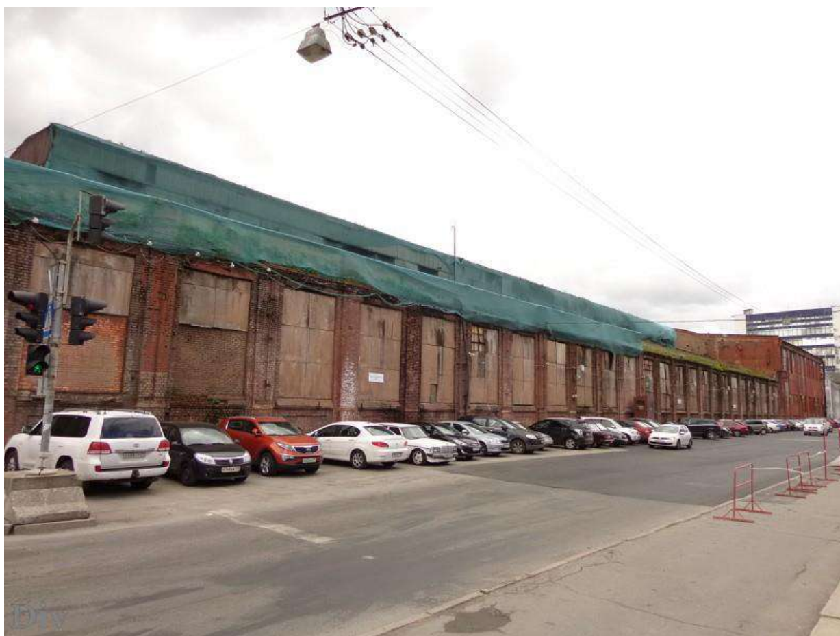
Илл. 35. Литейный цех со стороны переулка Фокина. 2014 г.
