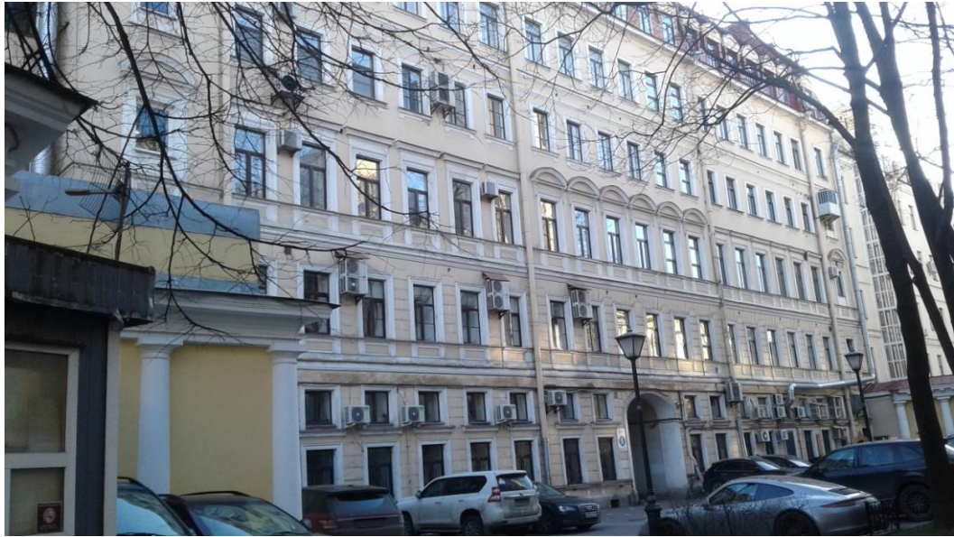
5. Выявленный объект культурного наследия «Дома немецкой лютеранской церкви св. Петра» (Невский пр., 22-24). Дом № 7 по Малой Конюшенной улице. Дворовый фасад. Общий вид.
