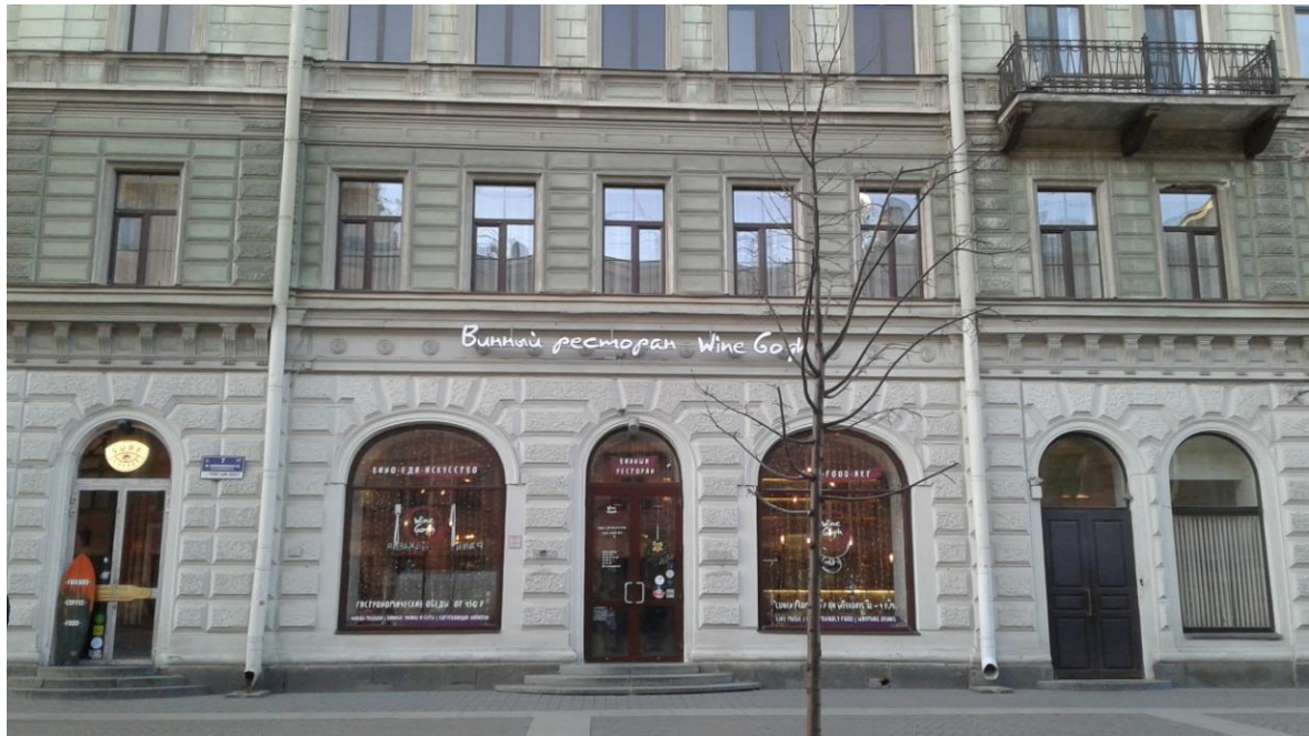
3. Выявленный объект культурного наследия «Дома немецкой лютеранской церкви св. Петра» (Невский пр., 22-24). Дом № 7 по Малой Конюшенной улице. Главный фасад. Вход (главный вход) в помещение 34-Н.
