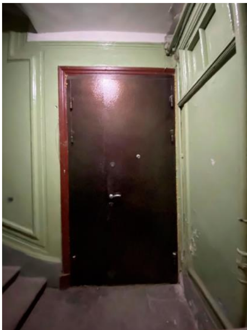
2. Входные дверные заполнения квартиры №100 в уровне 4-го этажа объекта культурного наследия федерального значения «Дом, где жили композиторы: в 1871-1872 гг. - Мусоргский М.П., в 1871-1872 гг. - Римский-Корсаков Н.А., в 1865 г. - Чайковский П.И.», расположенного по адресу: г. Санкт-Петербург, ул. Пестеля, д. 11, литера А. 15.02.2022.
