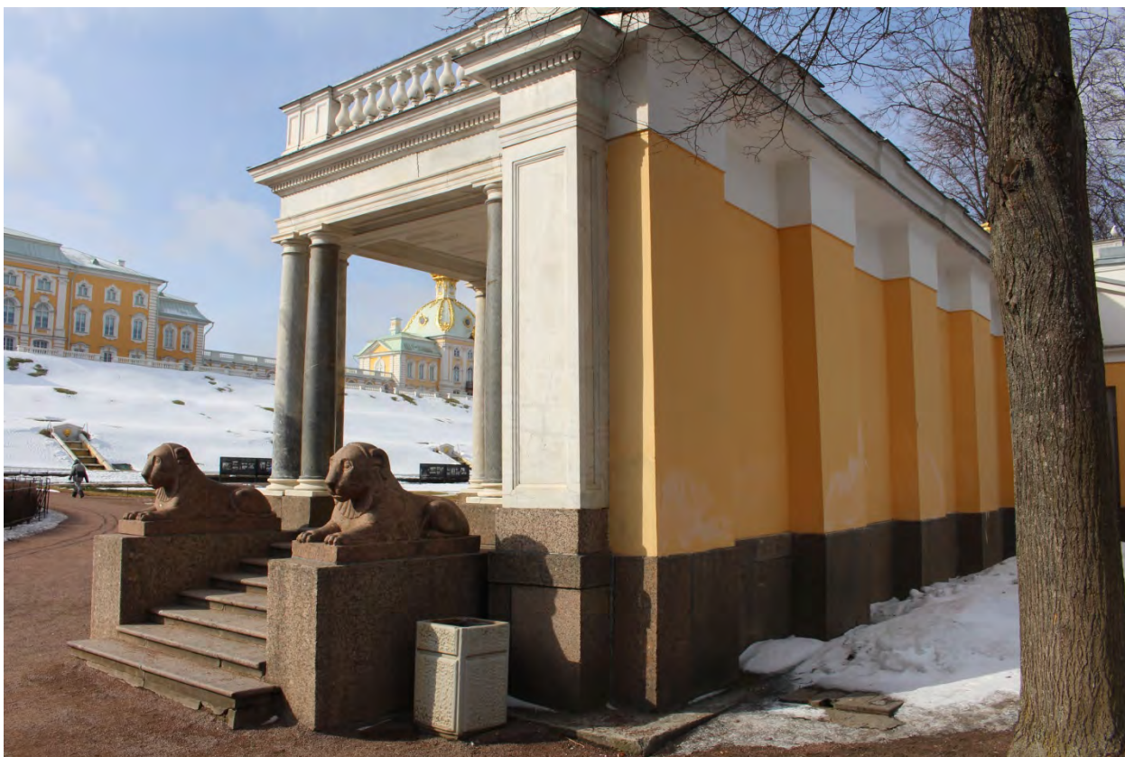
Фото 11. Вид западной колоннады с северо-востока.
