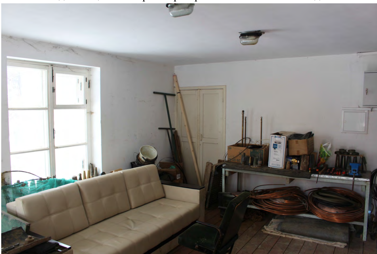
Фото 38. Вид помещения северной пристройки восточной колоннады с запада.
