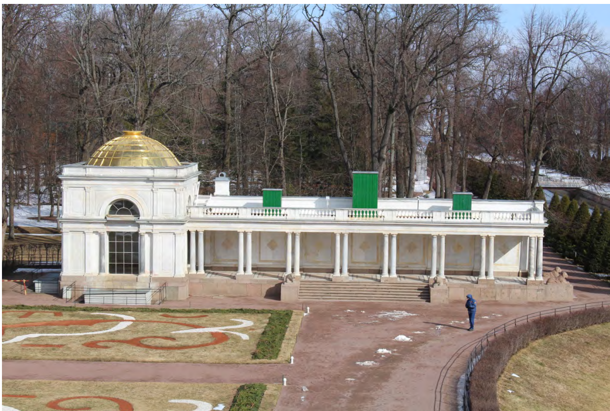
Фото 3. Общий вид западной колоннады.
