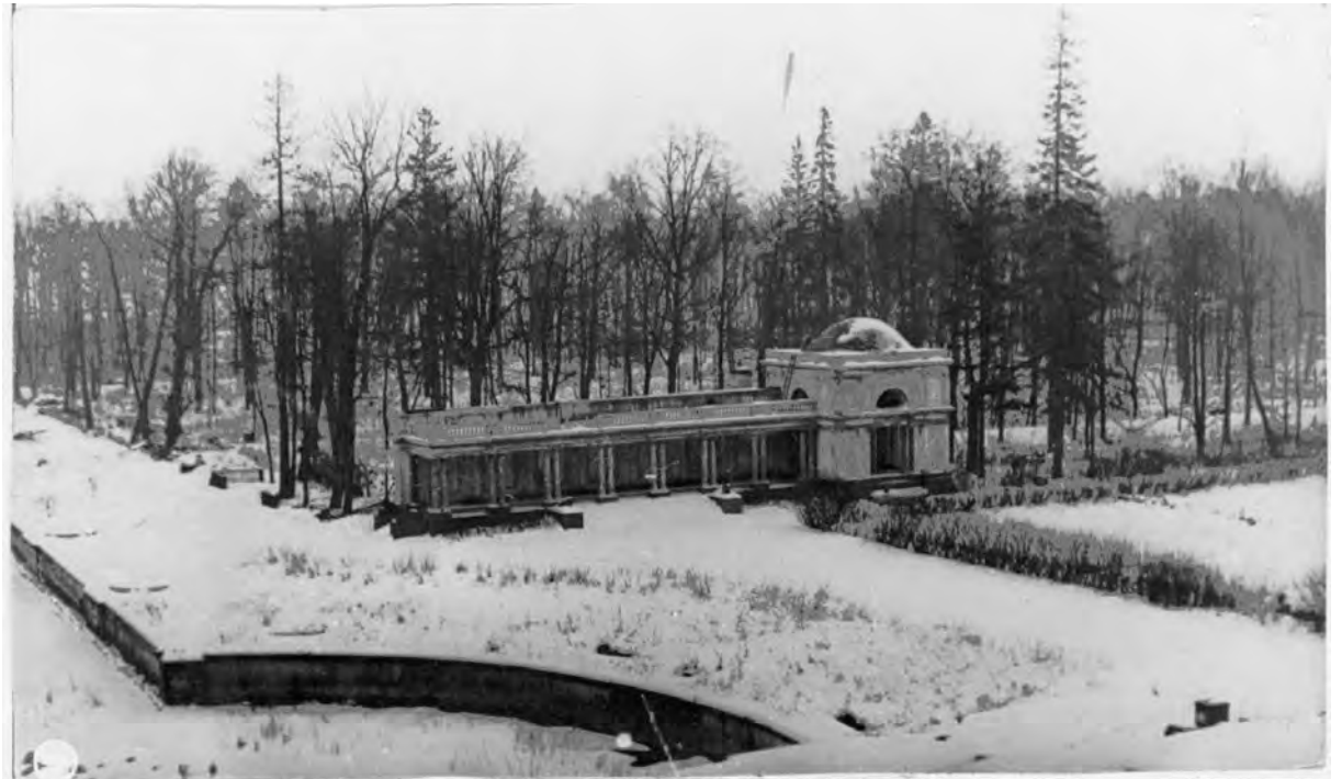
Илл. 25. Разрушенная восточная колоннада. 1944 г. Архив ГМЗ «Петергоф». Инв.№ ПДМП 3383-ФД.
