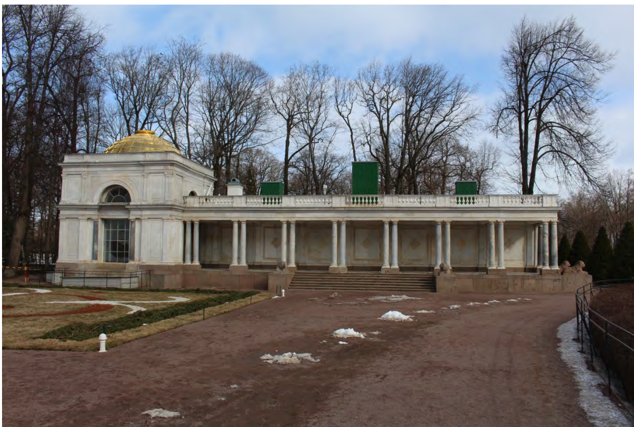
Фото 6. Южный фасад западной колоннады.
