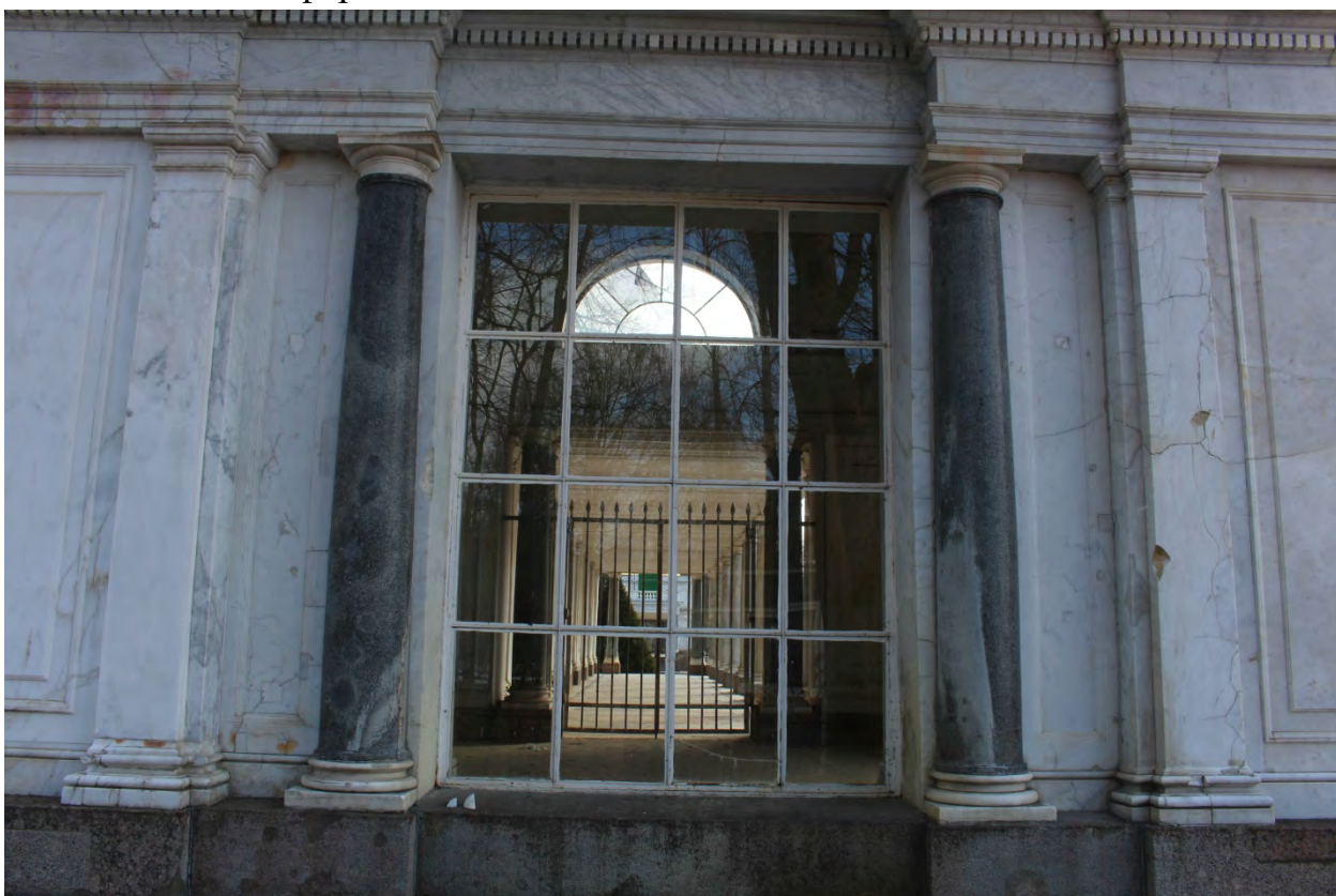
Фото 18. Оконное заполнение западного фасада западной колоннады.
