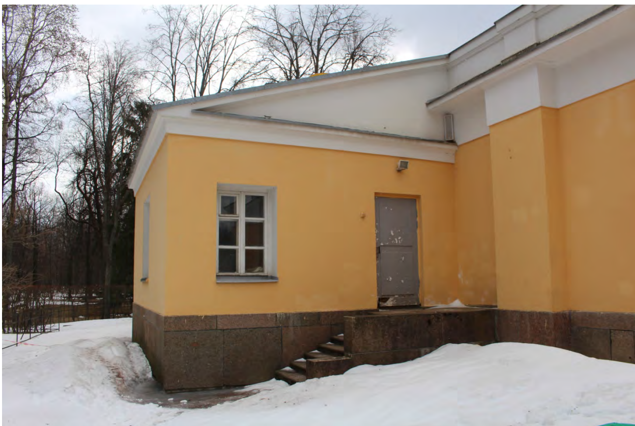
Фото 36. Вид северной пристройки восточной колоннады с северо-запада.
