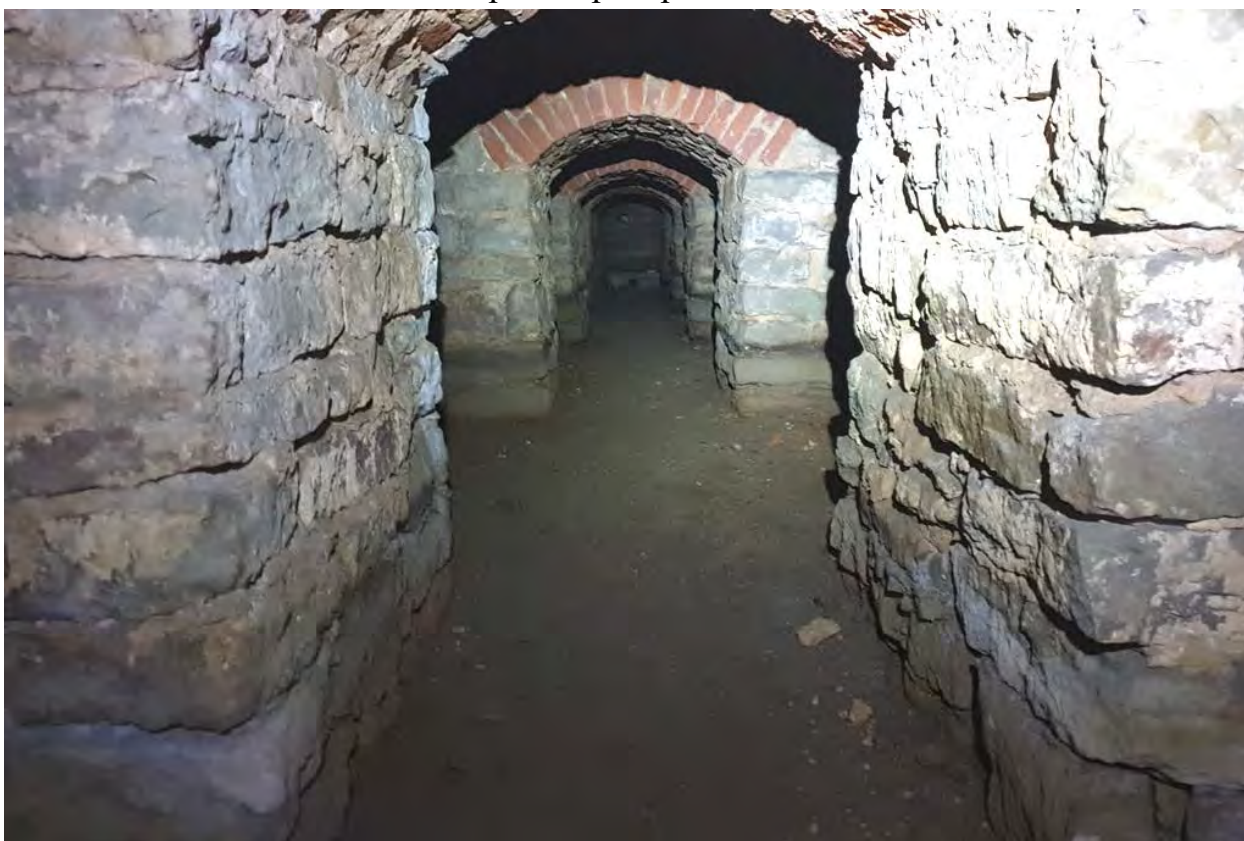
Фото 22п. Общий вид подвального помещения.
