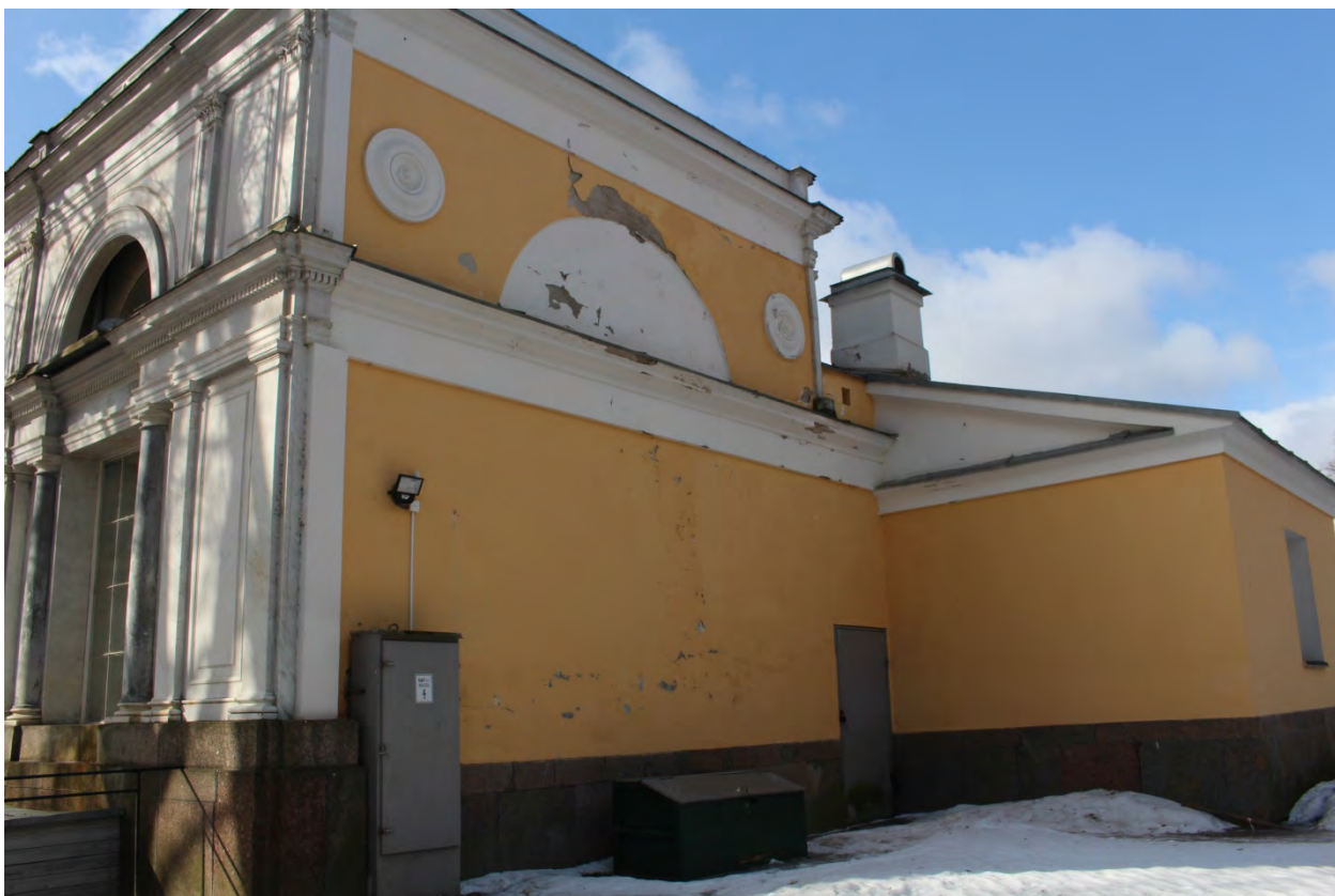
Фото 25. Вид восточной колоннады с северо-востока.
