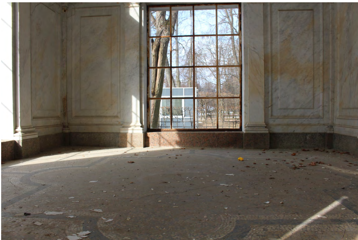
Фото 17. Оформление пола и стен павильона западной колоннады.
