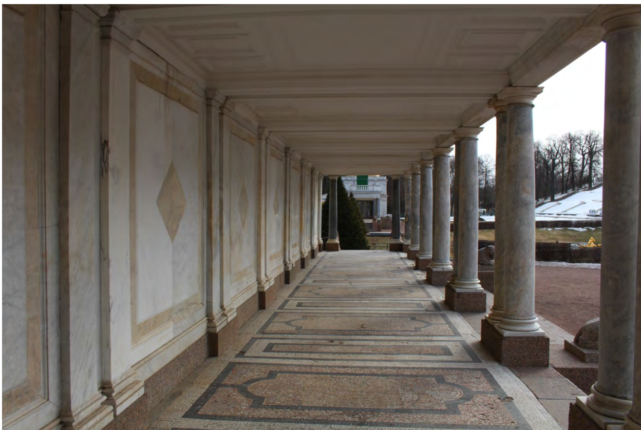
Фото 13. Вид галереи западной колоннады с запада.
