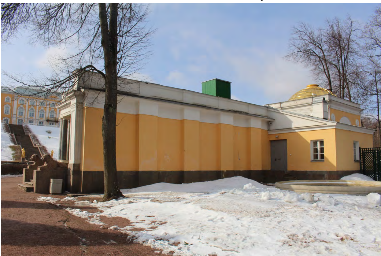
Фото 12. Общий вид западной колоннады с северо-востока.
