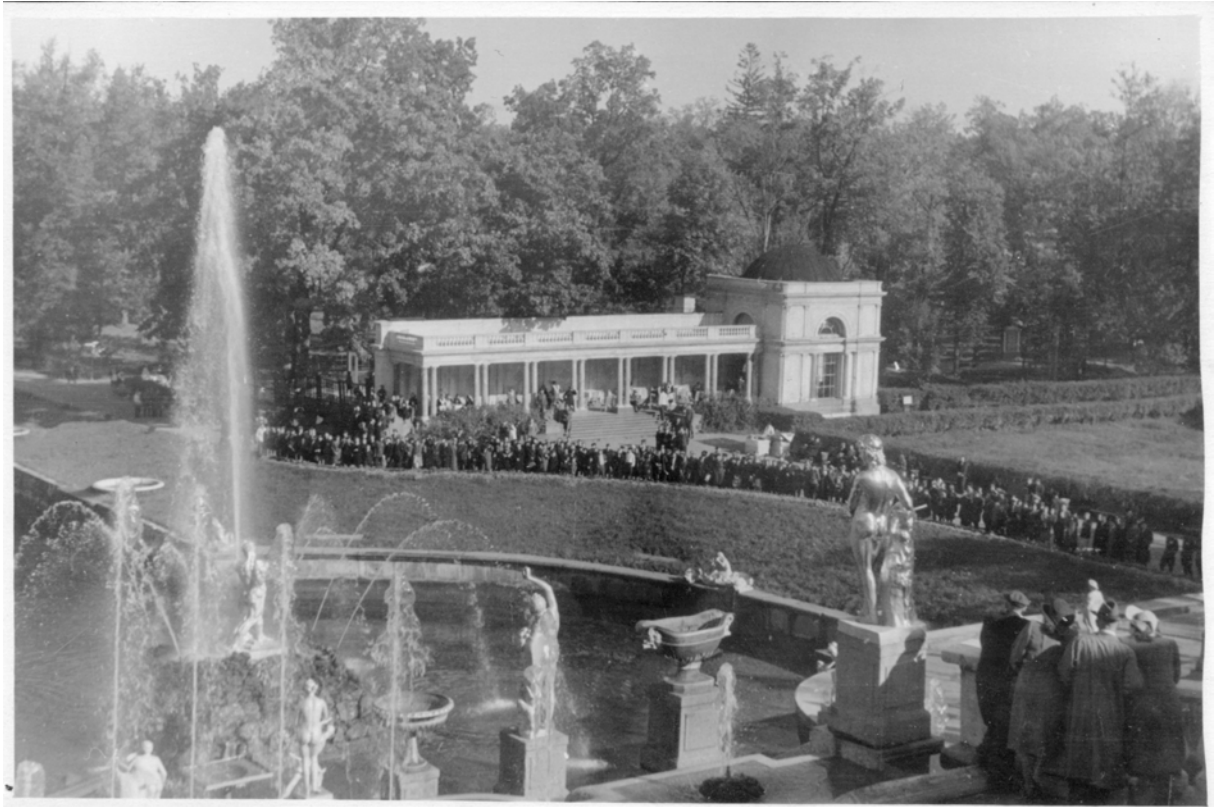
Илл. 30. Восточная колоннада. Между 1947 и 1949 гг. Архив ГМЗ «Петергоф». Инв.№ ПДМП 3397-ФД.
