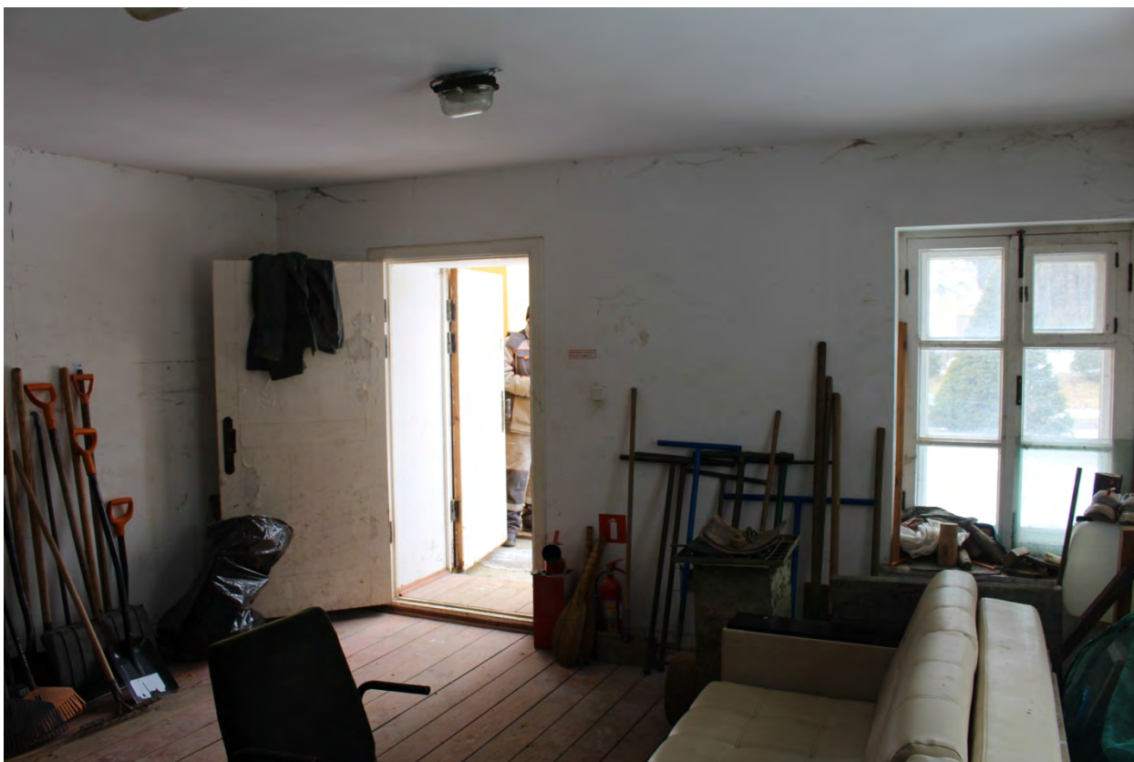
Фото 37. Вид помещения северной пристройки восточной колоннады с востока.
