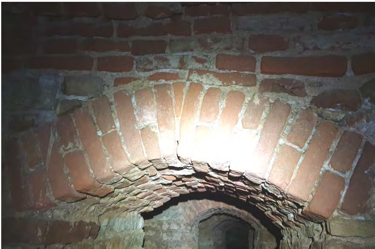
Фото 39п. Вид подвала и перемычек восточной колоннады.
