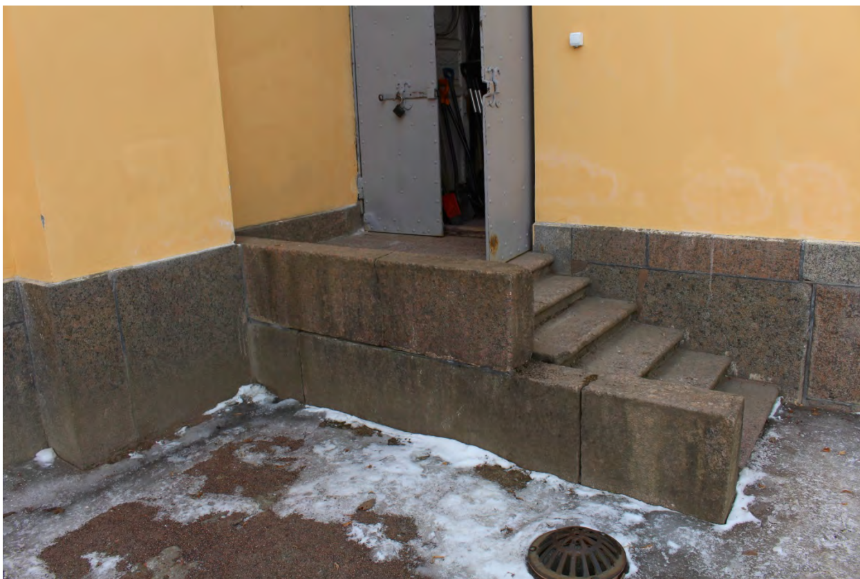
Фото 19. Северное крыльцо западной колоннады.
