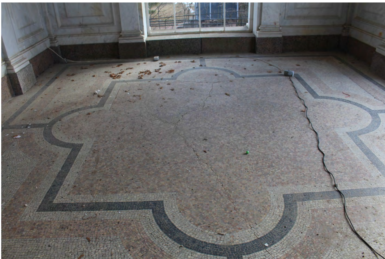
Фото 33. Покрытие пола павильона восточной колоннады.
