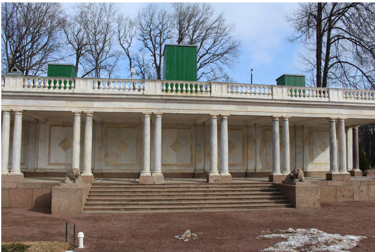
Фото 9. Центральная часть южного фасада западной колоннады.
