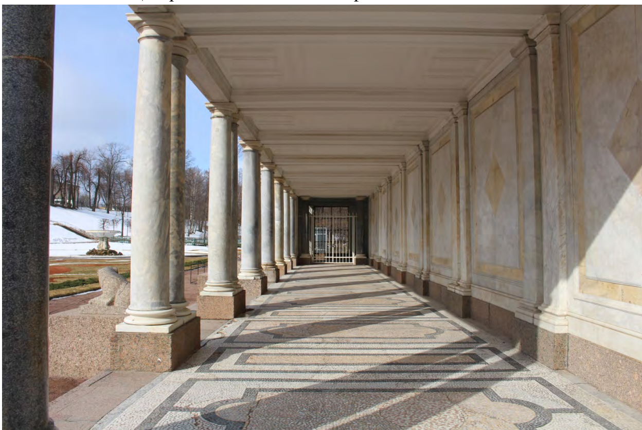
Фото 10. Вид на галерею западной колоннады с востока.
