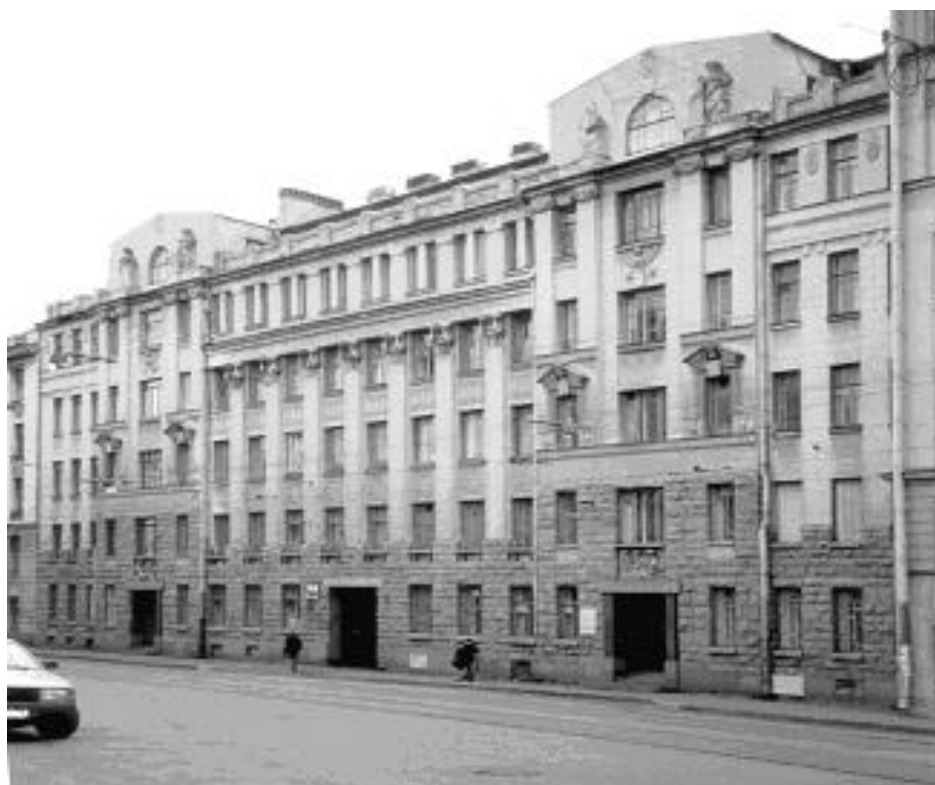
12. Объект культурного наследия регионального значения «Дом, в котором жил с 1915 по 1927 год и умер художник Б.М. Кустодиев» (рег. № 01-3-11969 от 01.12.2016 г) по адресу: г. Санкт-Петербург, Введенская улица, дом 7, литера А. Главный фасад. Фотография. 1999 г. КГИОП.
