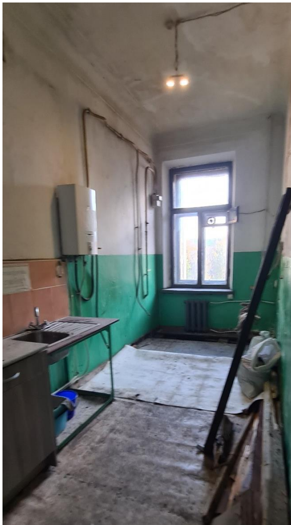
17. Объект культурного наследия регионального значения «Дом, в котором жил с 1915 по 1927 год и умер художник Б.М. Кустодиев» по адресу: Санкт-Петербург, Введенская улица, дом 7, литера А. Квартира 52. Кухня (помещение 1). Общий вид.
