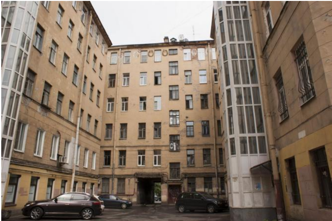
15. Объект культурного наследия регионального значения «Дом, в котором жил с 1915 по 1927 год и умер художник Б.М. Кустодиев» (рег. № 01-3-11969 от 01.12.2016 г) по адресу: г. Санкт-Петербург, Введенская улица, дом 7, литера А. Дворовые фасады. Фотография. 2010-е гг. https://p1.citywalls.ru/photo
