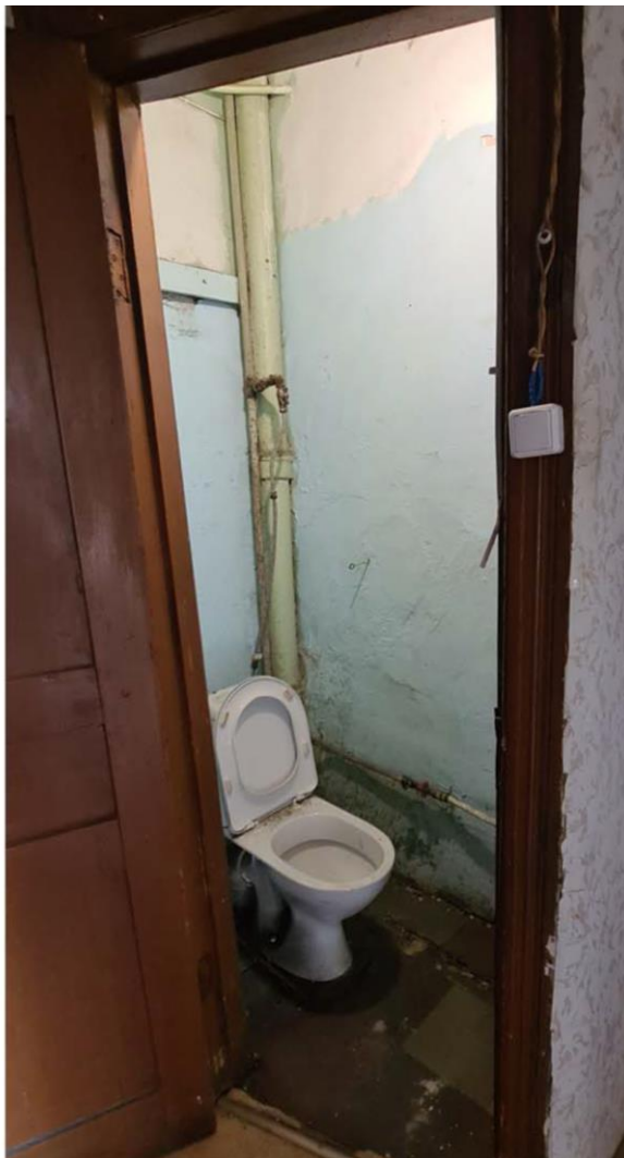
19. Объект культурного наследия регионального значения «Дом, в котором жил с 1915 по 1927 год и умер художник Б.М. Кустодиев» по адресу: Санкт-Петербург, Введенская улица, дом 7, литера А. Квартира 52. Туалет (помещение 13). Общий вид.
