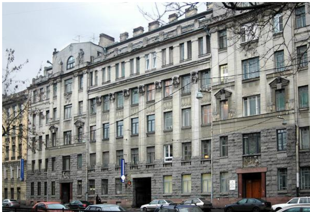
13. Объект культурного наследия регионального значения «Дом, в котором жил с 1915 по 1927 год и умер художник Б.М. Кустодиев» (рег. № 01-3-11969 от 01.12.2016 г) по адресу: г. Санкт-Петербург, Введенская улица, дом 7, литера А. Главный фасад. Фотография. 2010-е гг. https://p1.citywalls.ru/photo .
