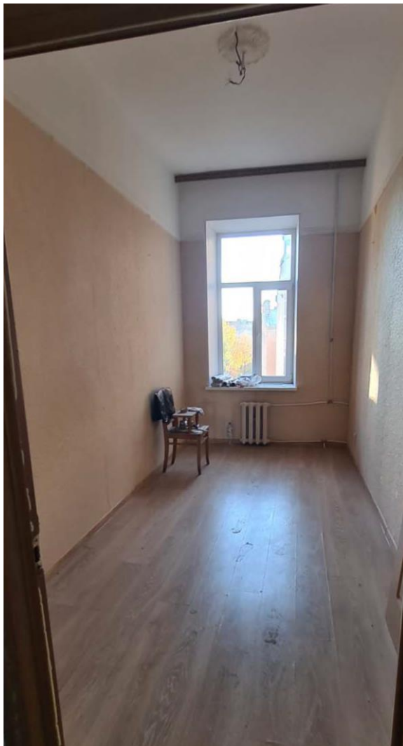
15. Объект культурного наследия регионального значения «Дом, в котором жил с 1915 по 1927 год и умер художник Б.М. Кустодиев» по адресу: Санкт-Петербург, Введенская улица, дом 7, литера А. Квартира 52. Жилая комната (помещение 3). Общий вид.
