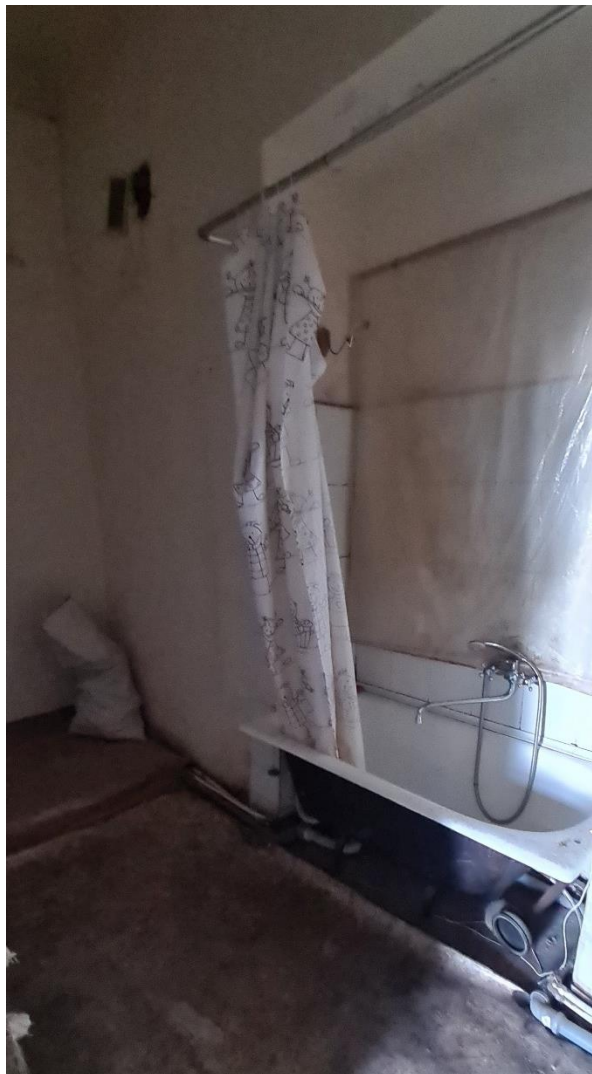
18. Объект культурного наследия регионального значения «Дом, в котором жил с 1915 по 1927 год и умер художник Б.М. Кустодиев» по адресу: Санкт-Петербург, Введенская улица, дом 7, литера А. Квартира 52. Ванная комната (помещение 14). Общий вид.
