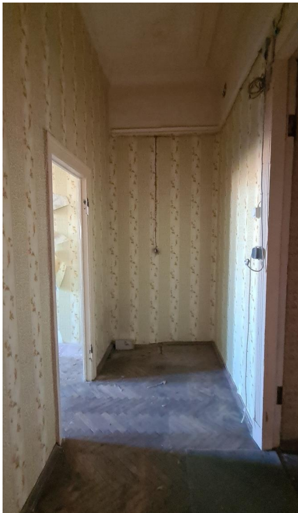
11. Объект культурного наследия регионального значения «Дом, в котором жил с 1915 по 1927 год и умер художник Б.М. Кустодиев» по адресу: Санкт-Петербург, Введенская улица, дом 7, литера А. Квартира 52. Помещение 17. Общий вид.
