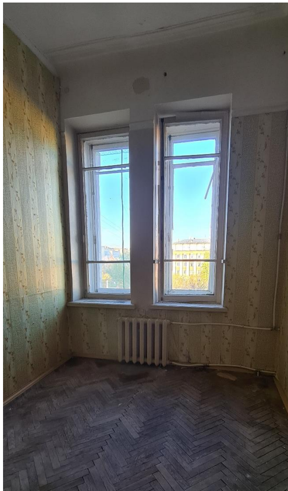
10. Объект культурного наследия регионального значения «Дом, в котором жил с 1915 по 1927 год и умер художник Б.М. Кустодиев» по адресу: Санкт-Петербург, Введенская улица, дом 7, литера А. Квартира 52. Жилая комната (помещение 11). Общий вид.
