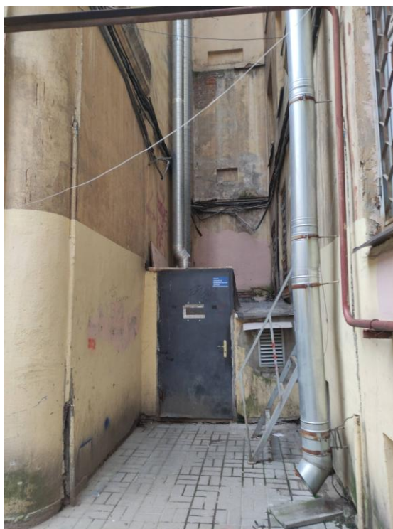
Фото 5. Фрагмент дворового фасада выявленного объекта культурного наследия «Дом Р.К. Сан-Галли», вход в помещение
