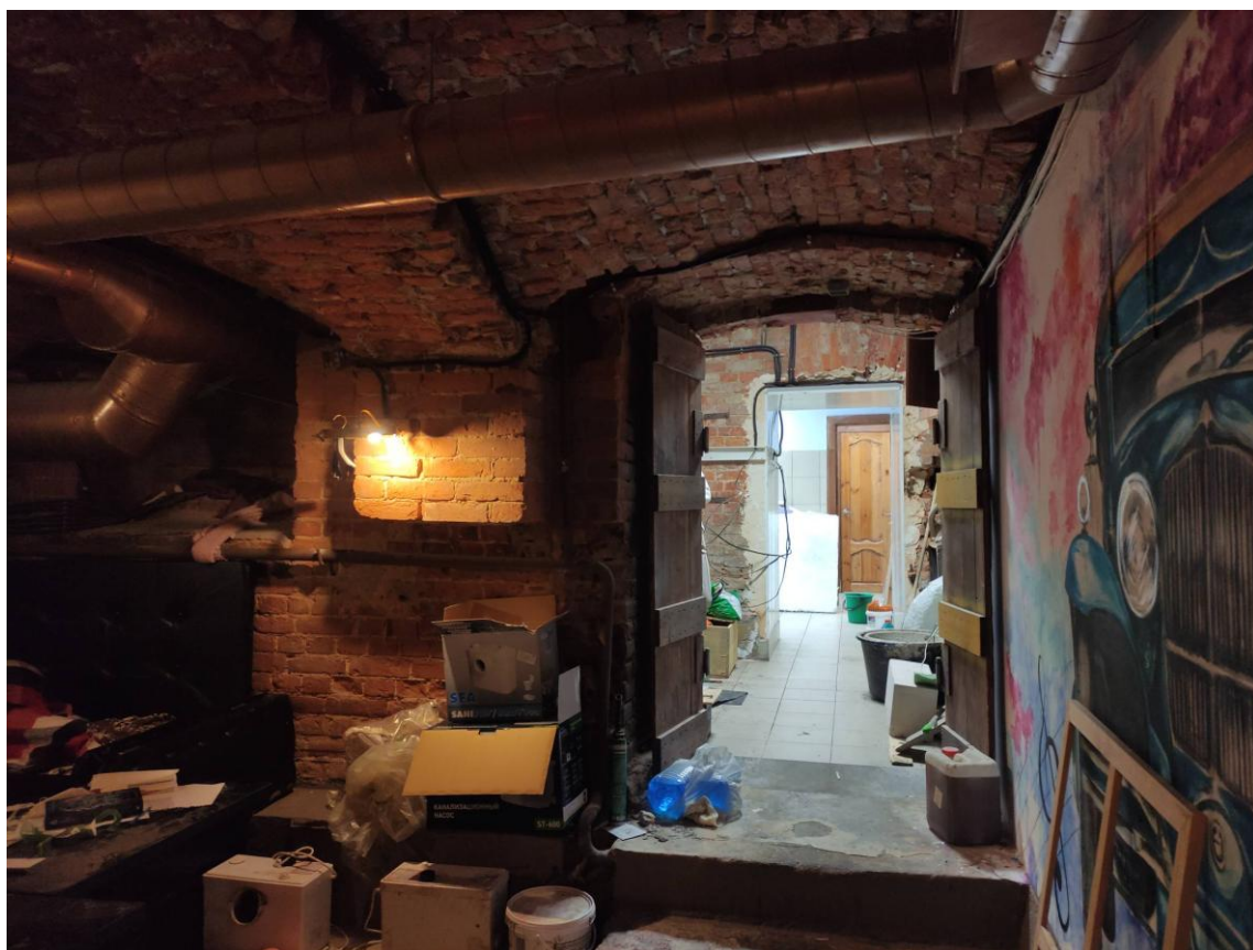
Фото 16. Интерьер пом.10-Н, ч.п. 9, вид на ч.п.10
