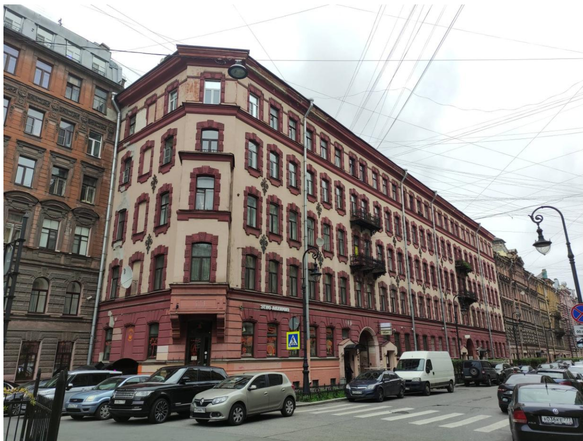
Фото 1. Общий вид выявленного объекта культурного наследия «Дом Р.К. Сан-Галли»
