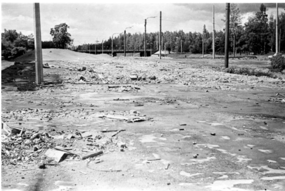
Илл. 58 Строительство Светановской площади. 1973 г.
