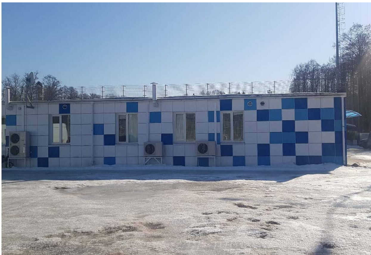
8. Территория проектирования в границах объекта культурного наследия регионального значения: «Удельный парк». Фасад павильона. Дата фотофиксации: 21.03.2022г.
