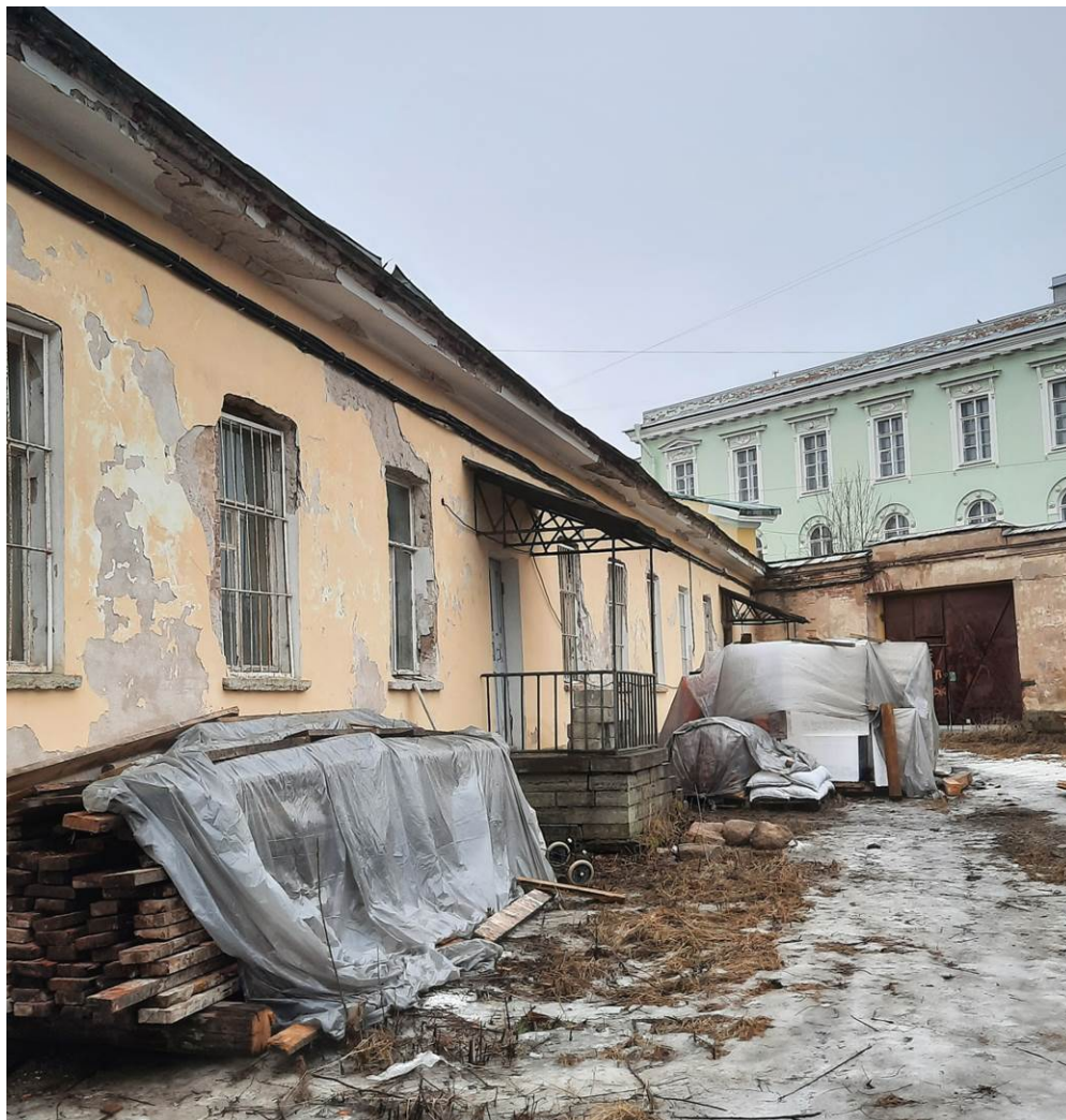
7. Объект культурного наследия регионального значения «3-я линия фруктовых теплиц с квартирами садовников и конторой» в составе объекта культурного наследия регионального значения комплекса «Дворцовые теплицы». Вид на западное крыло 3-й линии фруктовых теплиц с северо-востока.
