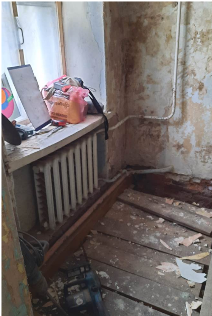
13. Объект культурного наследия регионального значения «3-я линия фруктовых теплиц с квартирами садовников и конторой» в составе объекта культурного наследия регионального значения комплекса «Дворцовые теплицы». Фрагмент пола в пом. 10.
