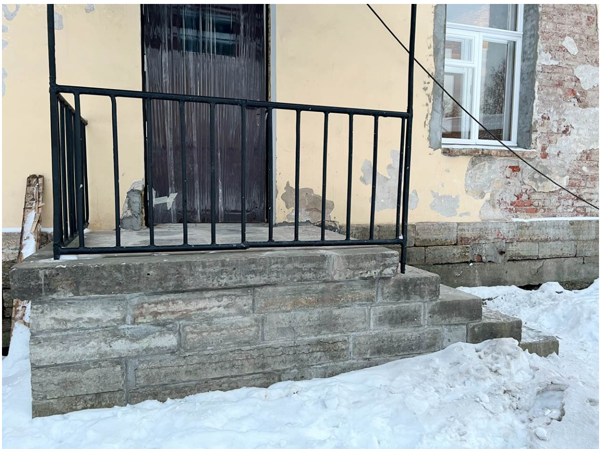
4. Объект культурного наследия регионального значения «3-я линия фруктовых теплиц с квартирами садовников и конторой» в составе объекта культурного наследия регионального значения комплекса «Дворцовые теплицы». Фрагмент северного фасада западного крыла 3-й линии фруктовых теплиц. Крыльцо входа в пом. 5-Н.
