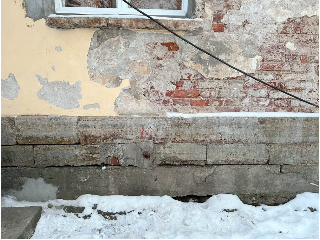
6. Объект культурного наследия регионального значения «3-я линия фруктовых теплиц с квартирами садовников и конторой» в составе объекта культурного наследия регионального значения комплекса «Дворцовые теплицы». Фрагмент северного фасада западного крыла 3-й линии фруктовых теплиц. Цоколь здания.
