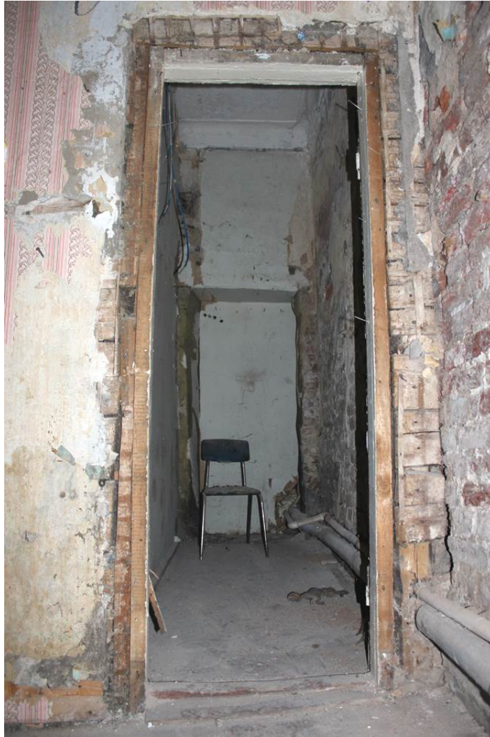
11. Объект культурного наследия регионального значения «3-я линия фруктовых теплиц с квартирами садовников и конторой» в составе объекта культурного наследия регионального значения комплекса «Дворцовые теплицы». Коридор (пом. 8) Вид от поперечной стены по оси 3 в сторону стены по оси 5.
