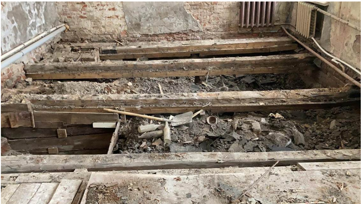
18. Объект культурного наследия регионального значения «3-я линия фруктовых теплиц с квартирами садовников и конторой» в составе объекта культурного наследия регионального значения комплекса «Дворцовые теплицы». Помещение 10. Вскрытие полов.
