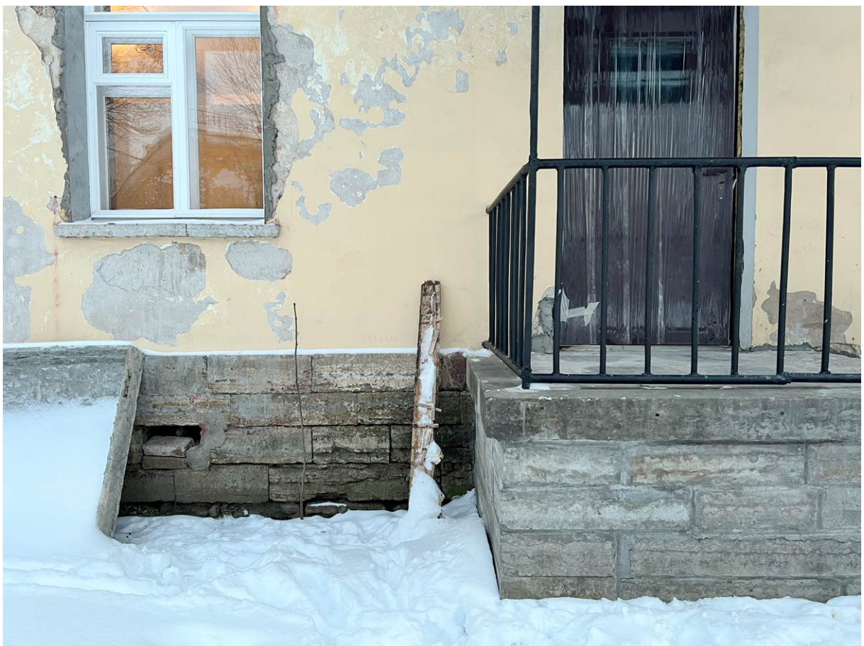
5. Объект культурного наследия регионального значения «3-я линия фруктовых теплиц с квартирами садовников и конторой» в составе объекта культурного наследия регионального значения комплекса «Дворцовые теплицы». Фрагмент северного фасада западного крыла 3-й линии фруктовых теплиц. Крыльцо входа в пом. 5-Н.
