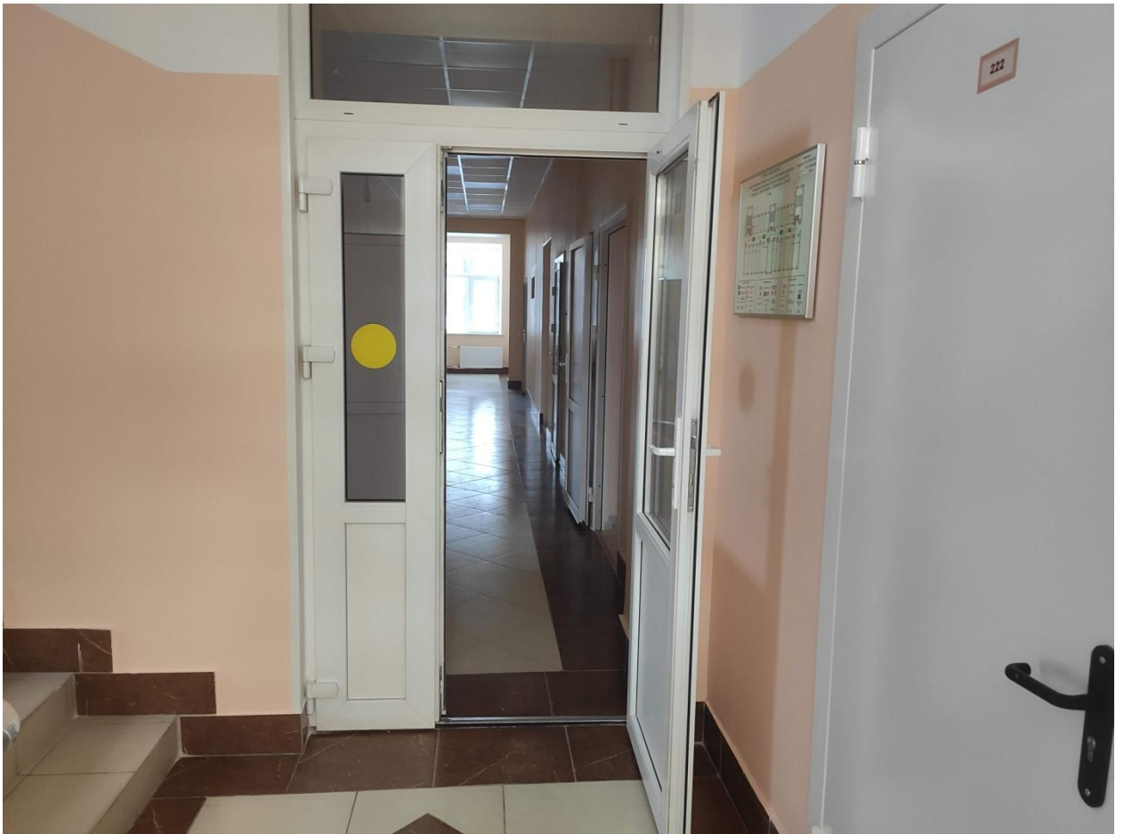
Илл. 93. Вход в коридор 2 этажа в западном объеме здания.
