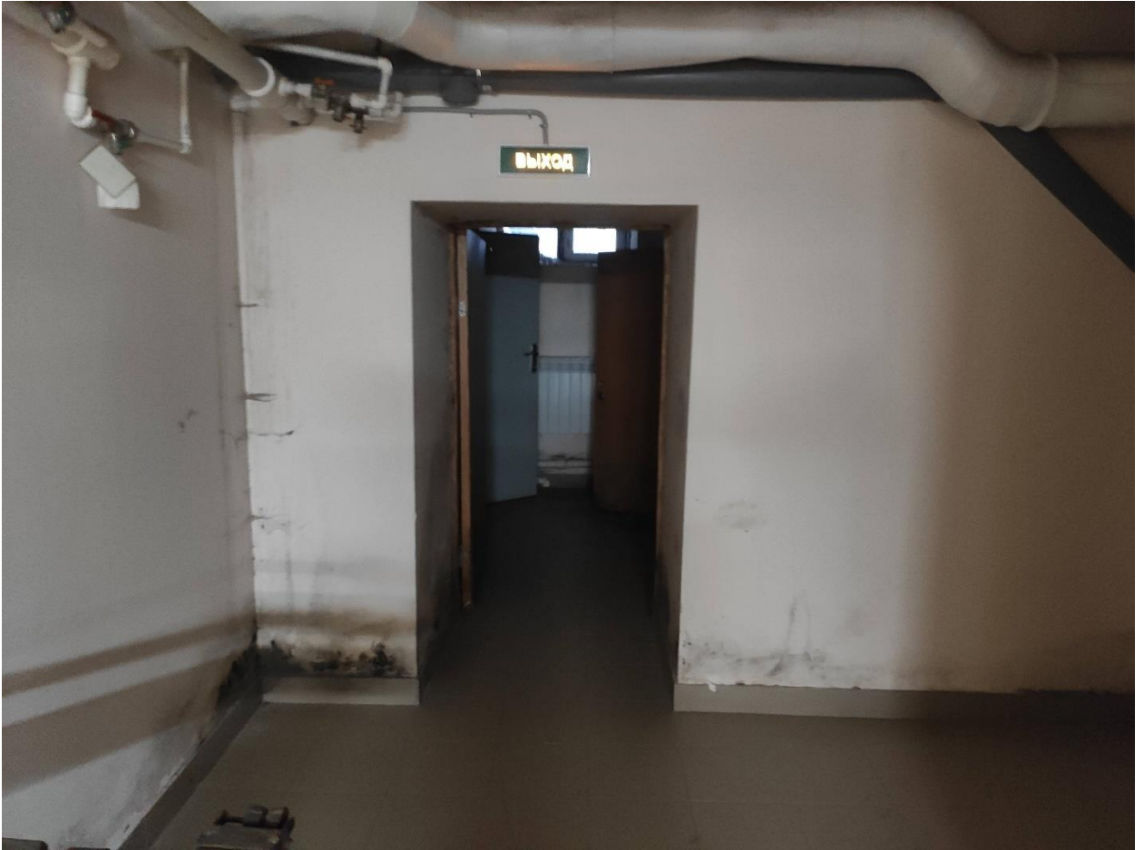
Илл. 33. Дверь в подвальном помещении в восточной части здания.
