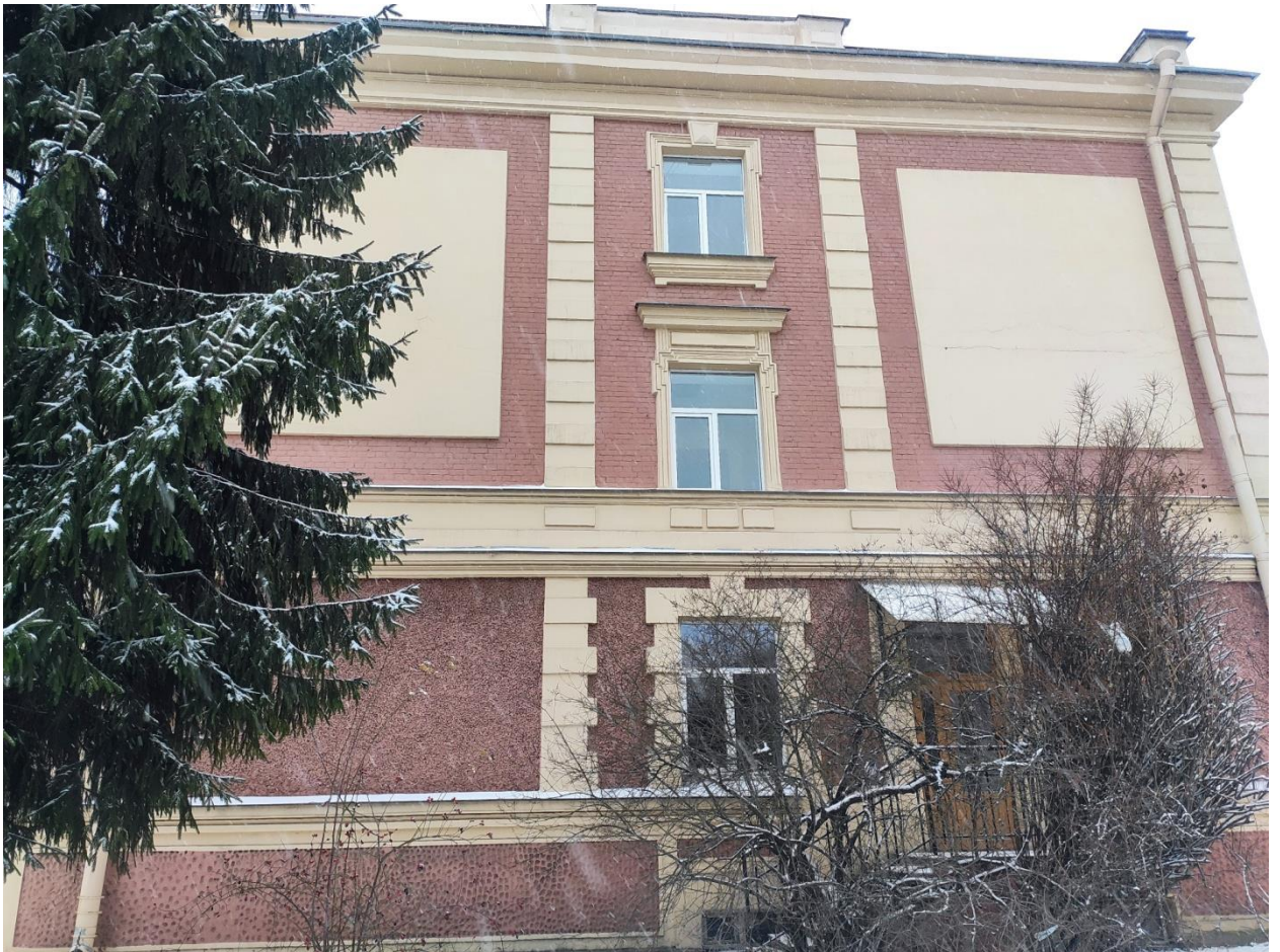
Илл. 14. Торцевой фасад здания.
