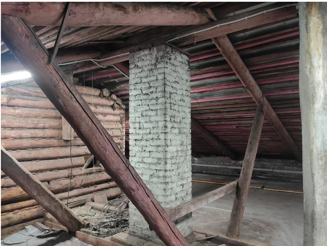
Илл. 167. Помещения чердака.
