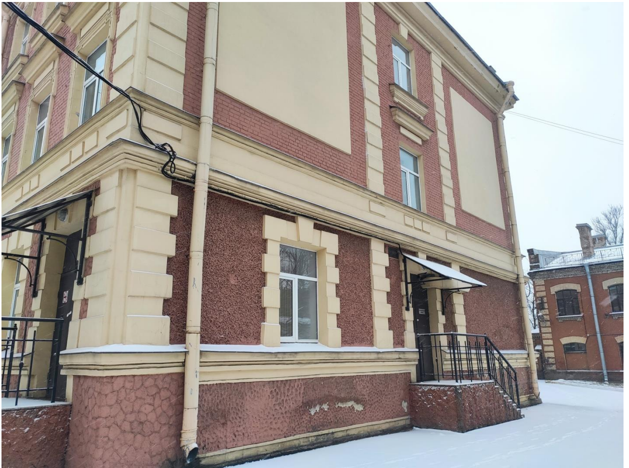
Илл. 4. Торцевой фасад здания.
