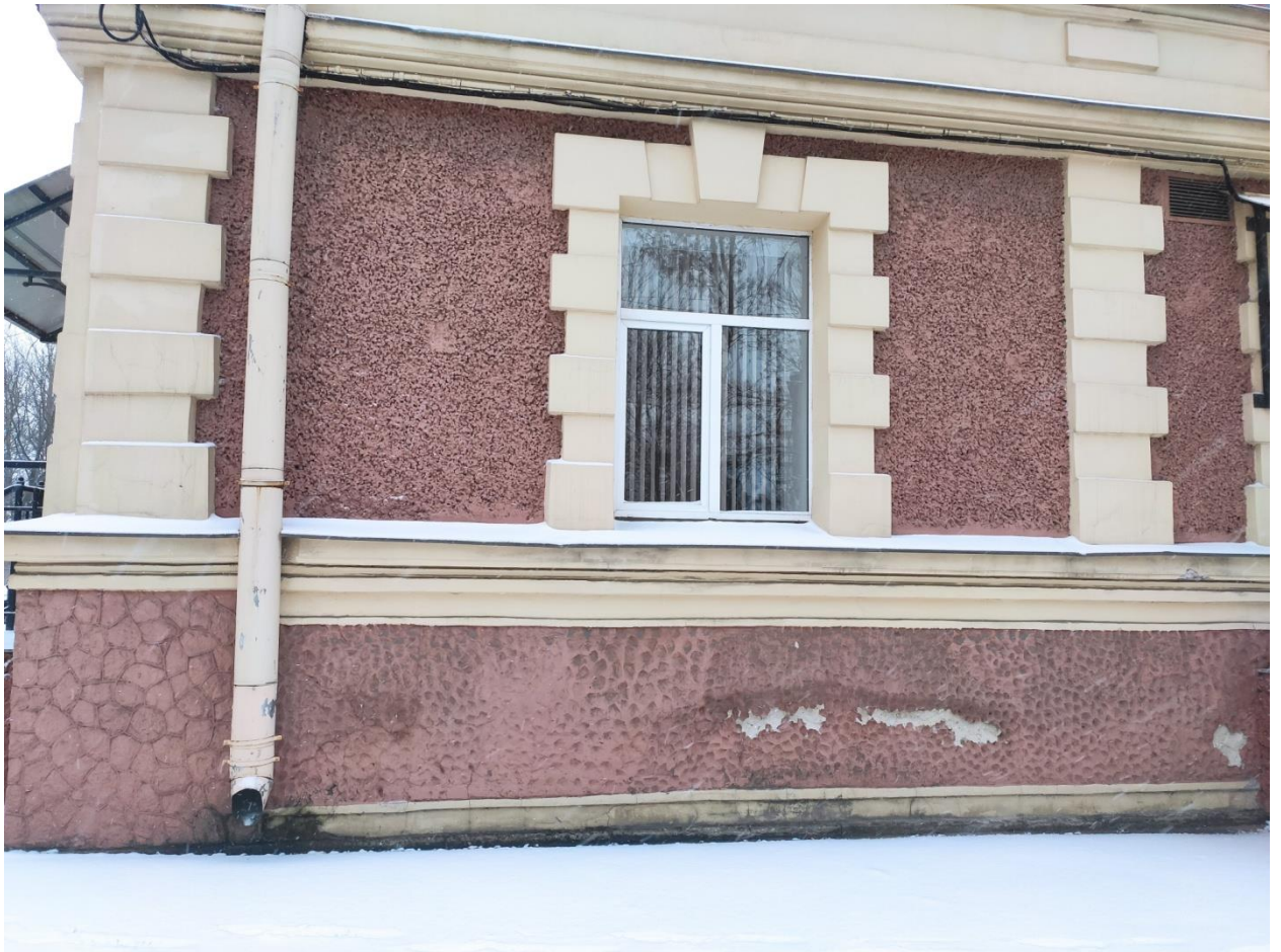
Илл. 6. Торцевой фасад здания.
