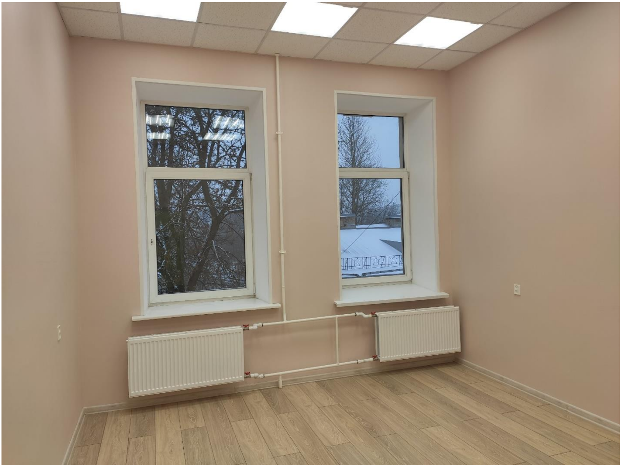
Илл. 133. Помещение 3 этажа в западном объеме здания.
