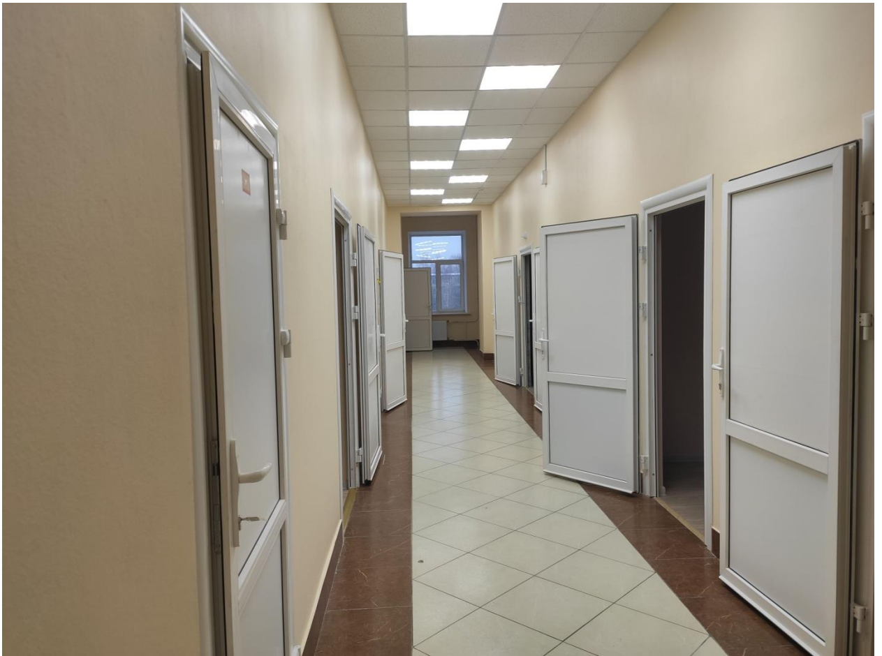
Илл. 111. Коридор 3 этажа в восточном объеме здания.
