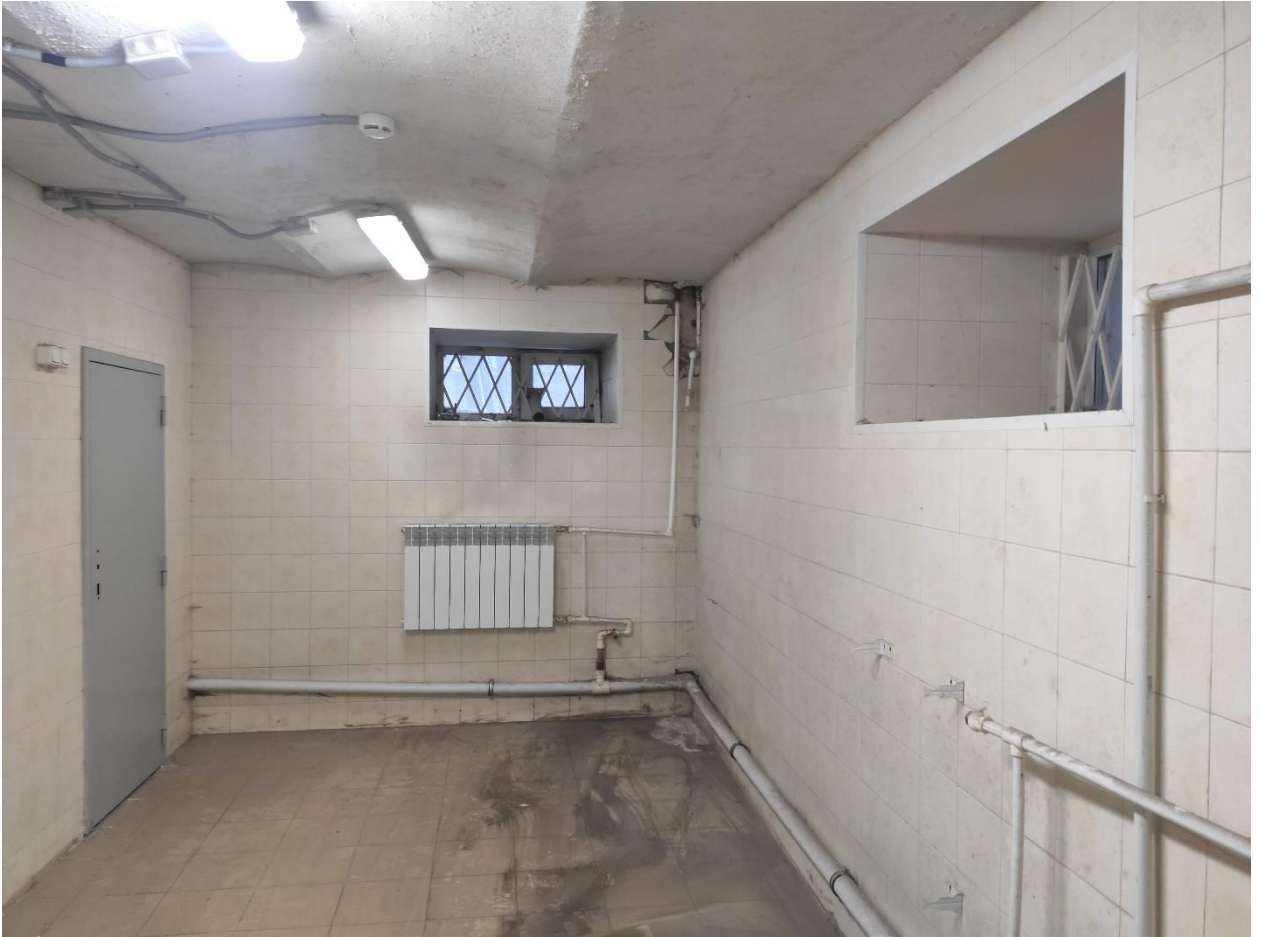
Илл. 37. Подвальное помещение в восточной части здания.
