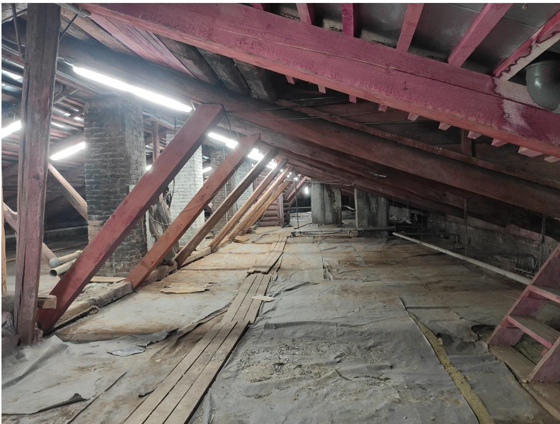
Илл. 163. Помещения чердака.
