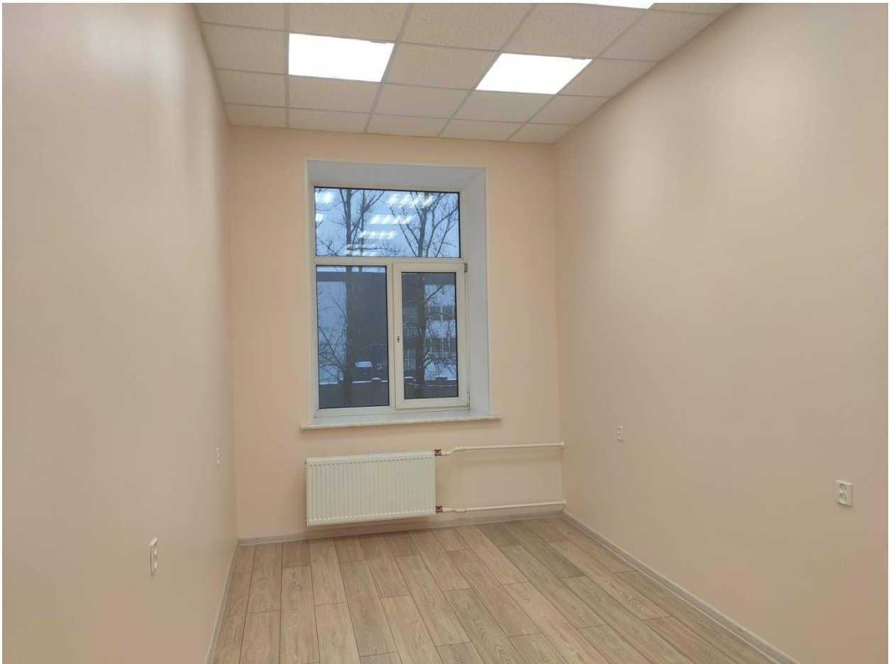
Илл. 107. Помещение 2 этажа в западном объеме здания.
