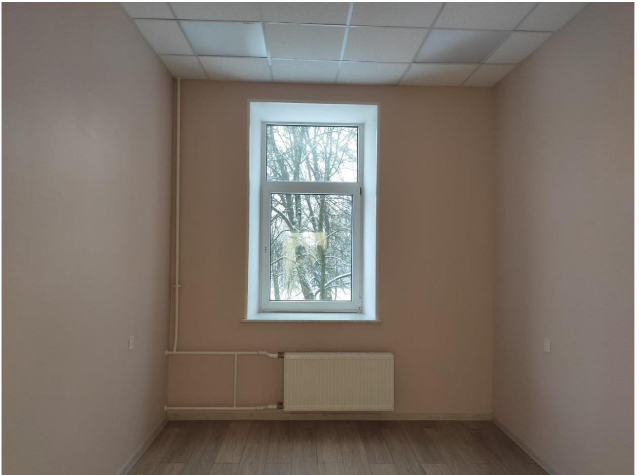
Илл. 82. Помещение 2 этажа в восточном объеме здания.
