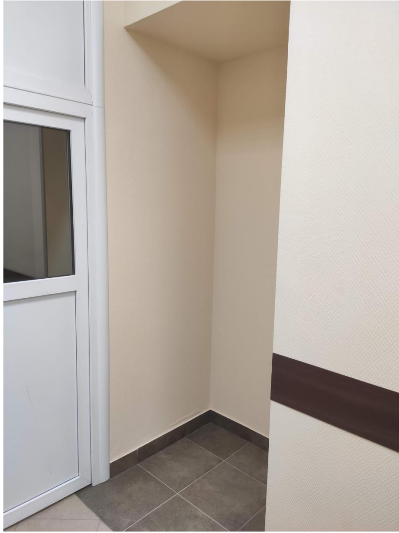
Илл. 49. Ниша в коридоре 1 этажа в западном объеме здания.
