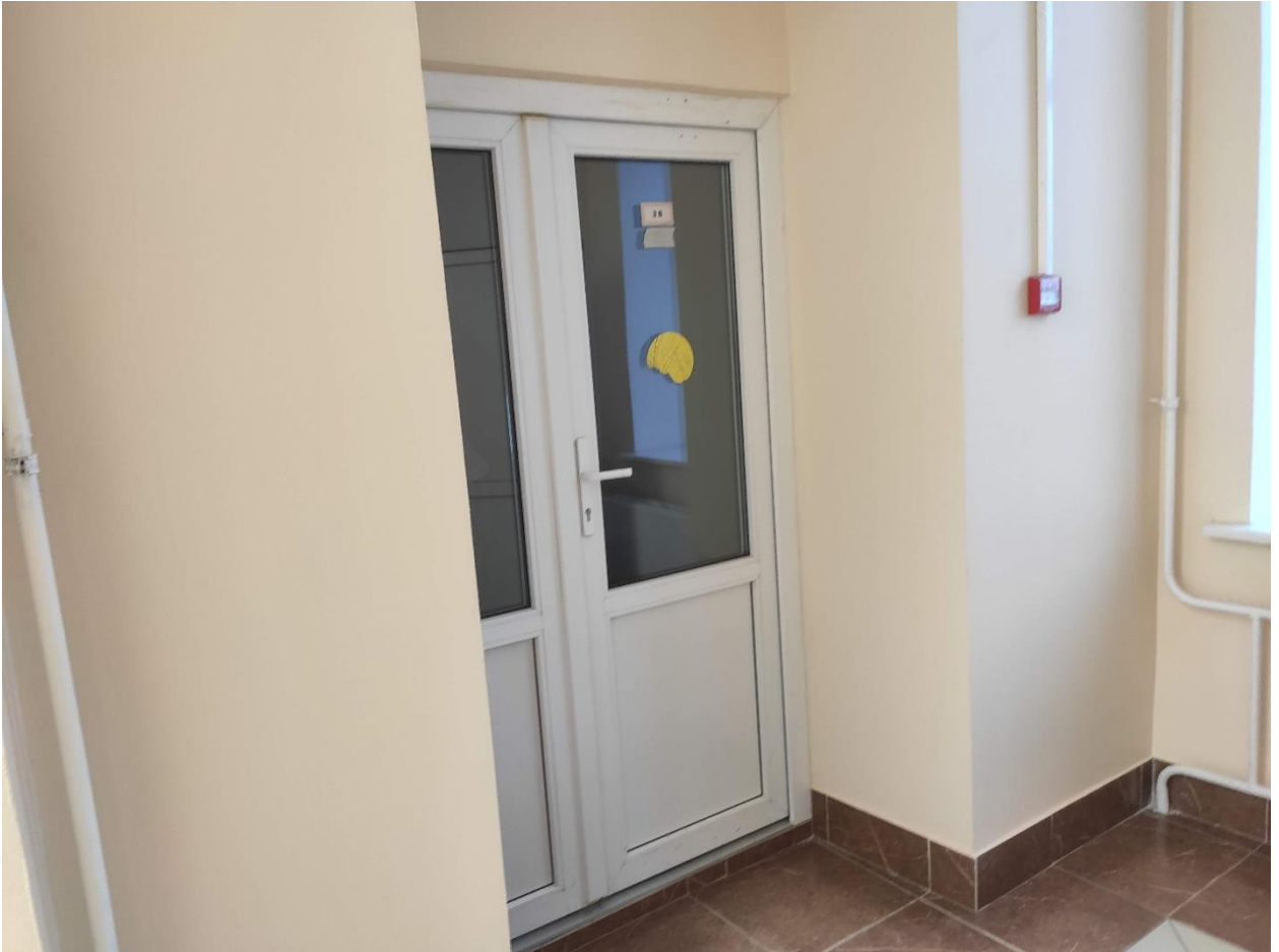
Илл. 135. Дверь в коридоре 3 этажа в западном объеме здания.
