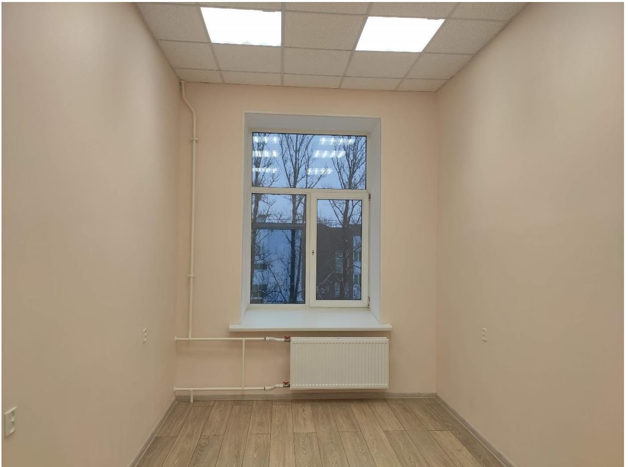
Илл. 146. Помещение 3 этажа в западном объеме здания.
