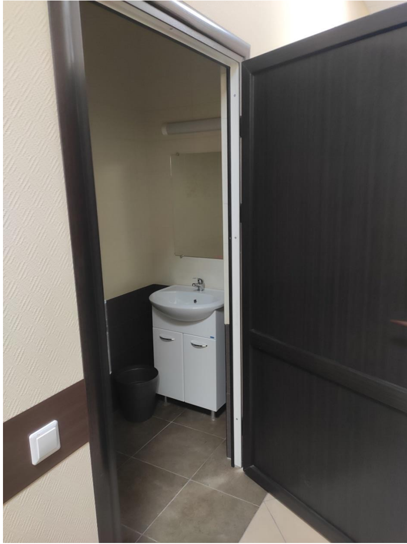
Илл. 61. Помещение 1 этажа в восточном объеме здания.
