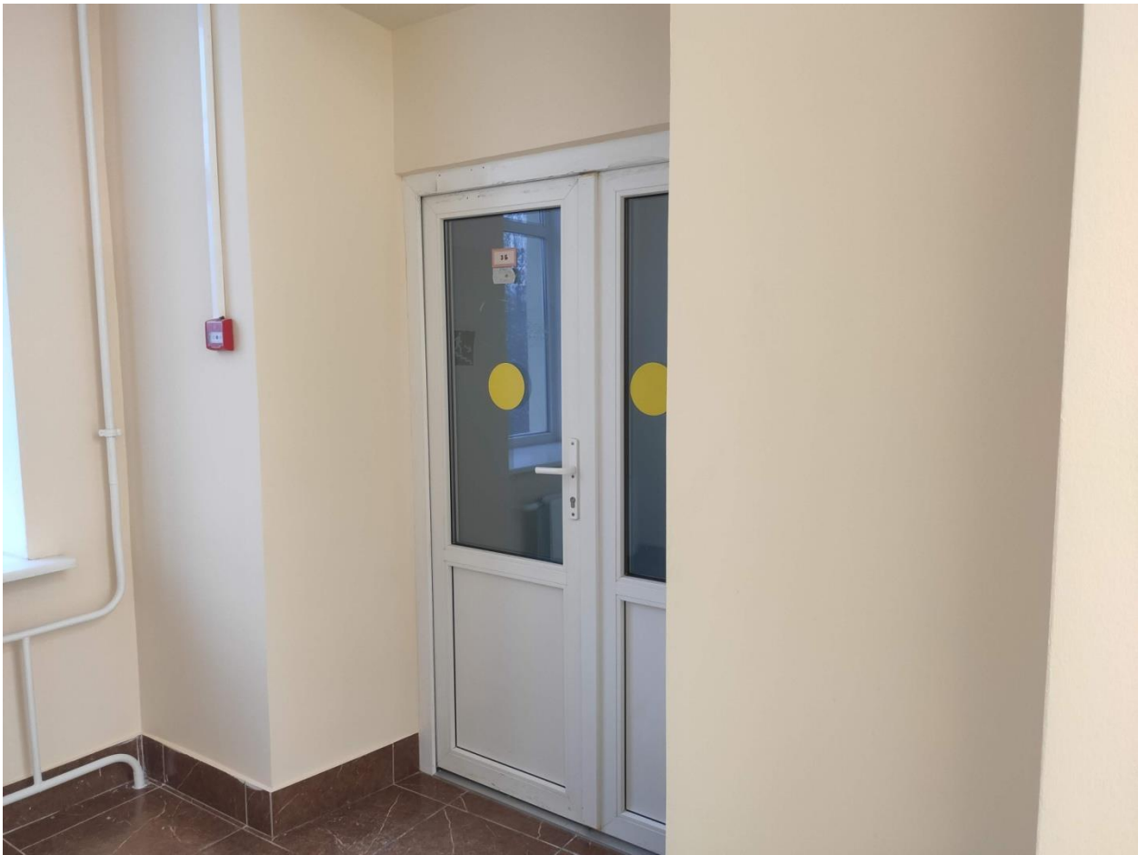
Илл. 118. Дверь в коридоре 3 этажа в восточном объеме здания.
