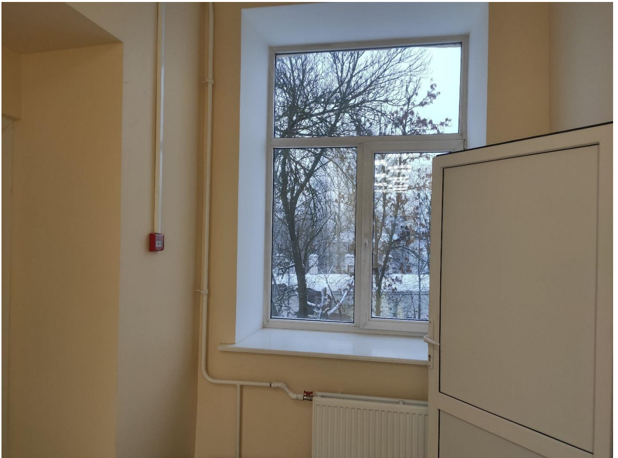
Илл. 136. Окно в коридоре 3 этажа в западном объеме здания.
