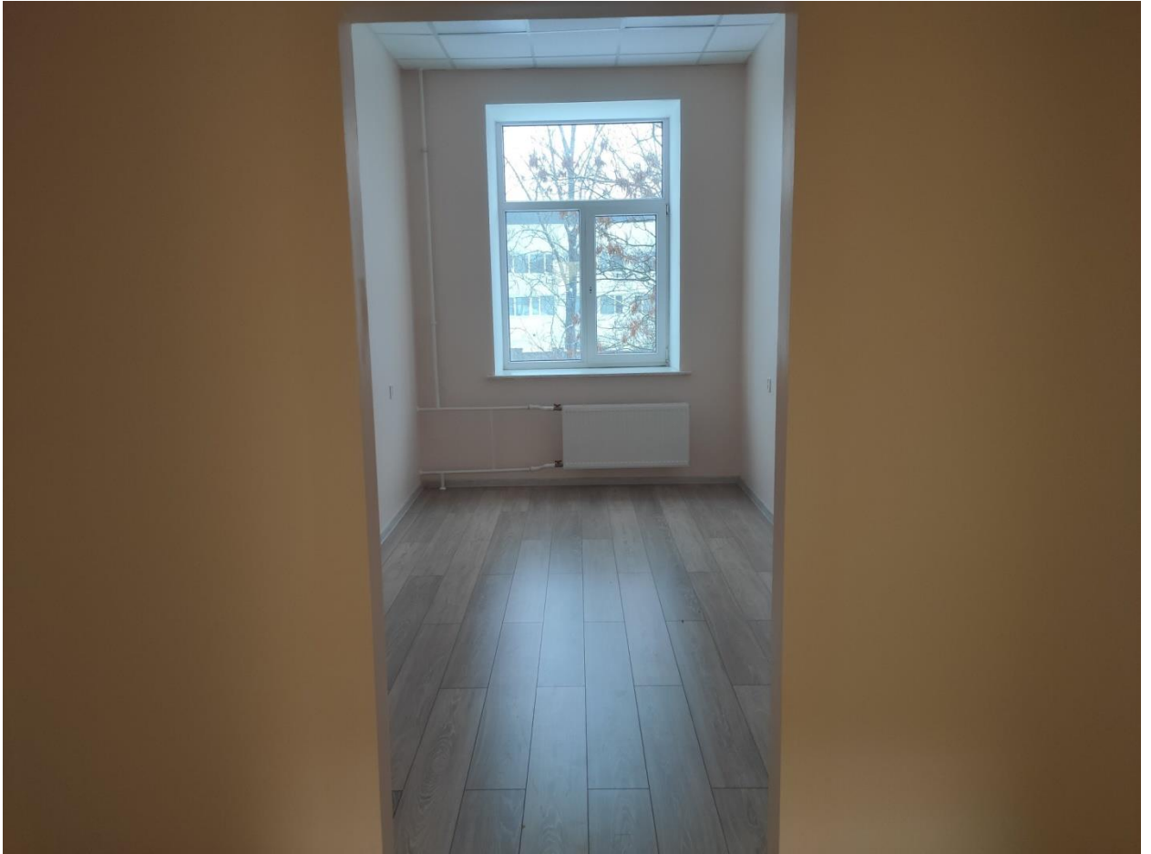
Илл. 89. Помещение 2 этажа в восточном объеме здания.
