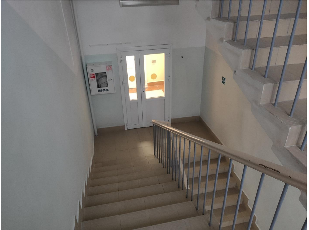
Илл. 160. Лестница в восточном объеме здания.
