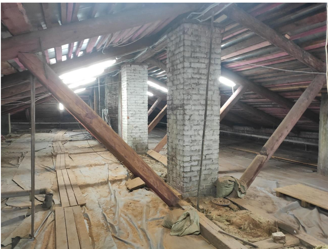
Илл. 168. Помещения чердака.
