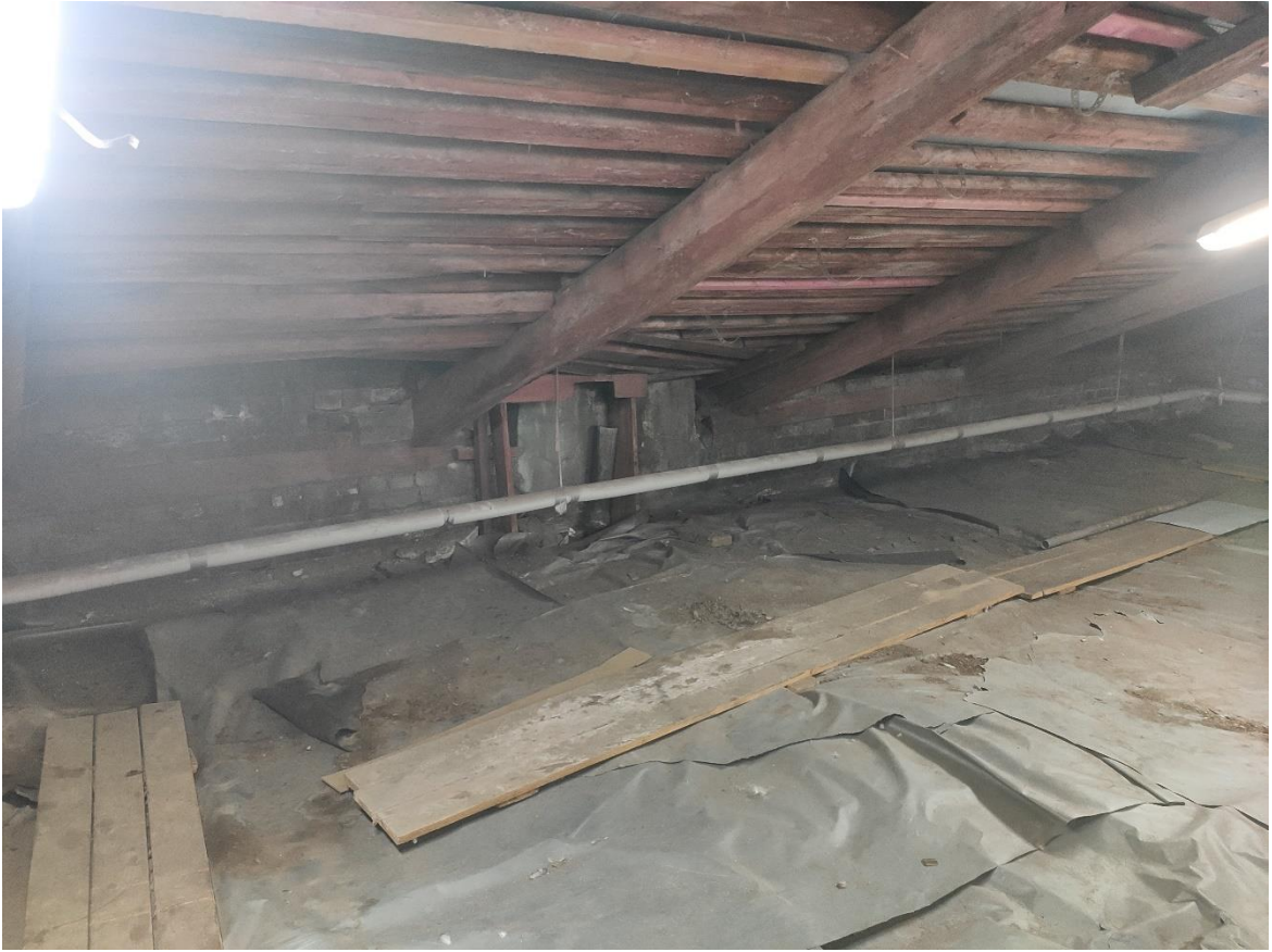
Илл. 169. Помещения чердака.
