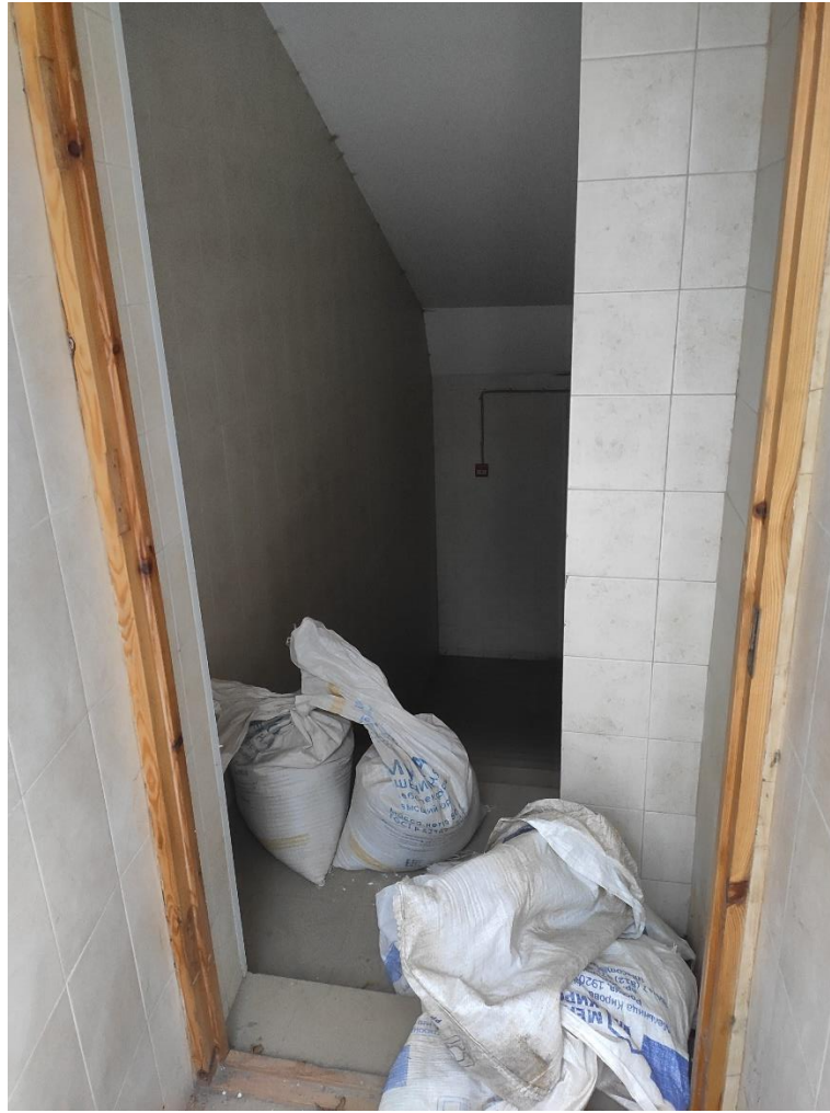
Илл. 25. Подвальное помещение в восточной части здания.
