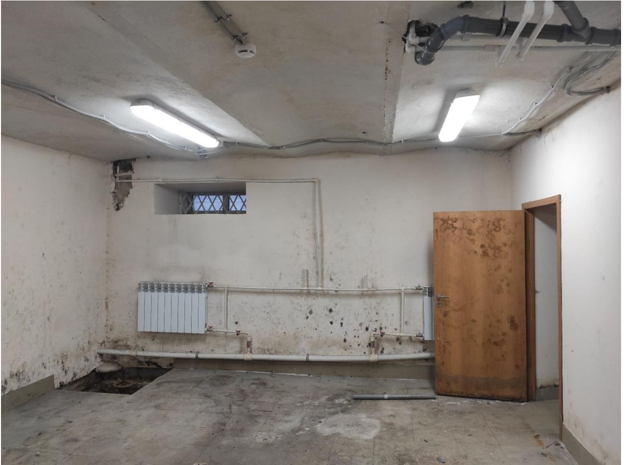
Илл. 30. Фрагмент подвального помещения в восточной части здания.
