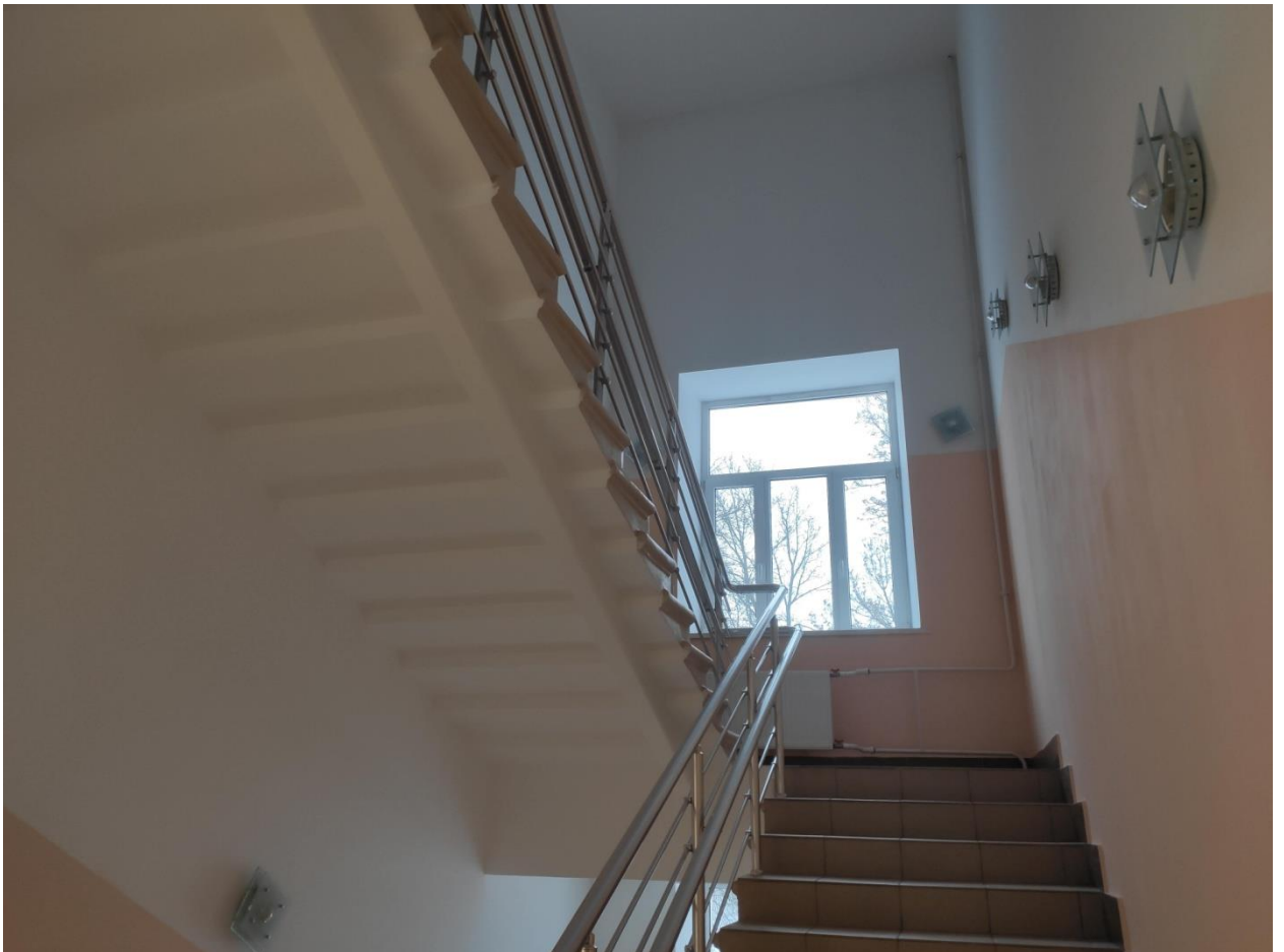
Илл. 109. Окно на лестничной клетке между 2 и 3 этажами в центральном объеме здания.
