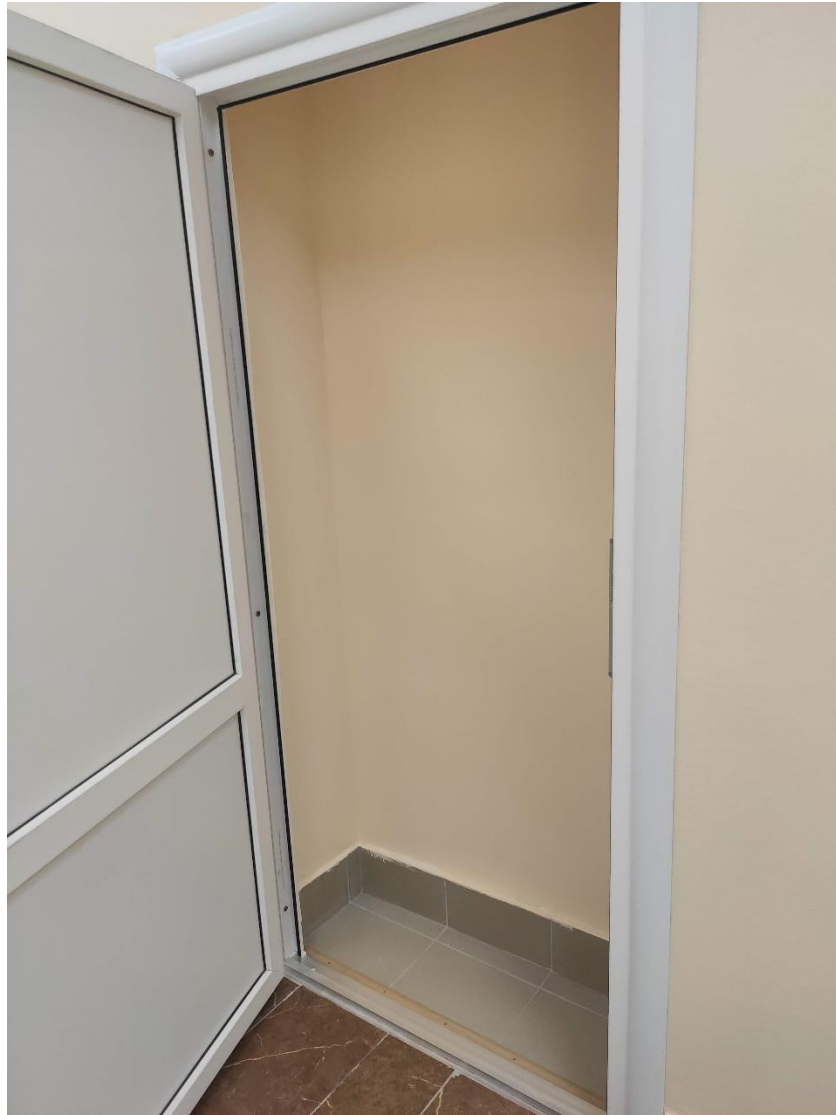
Илл. 143. Ниша в коридоре 3 этажа в западном объеме здания.
