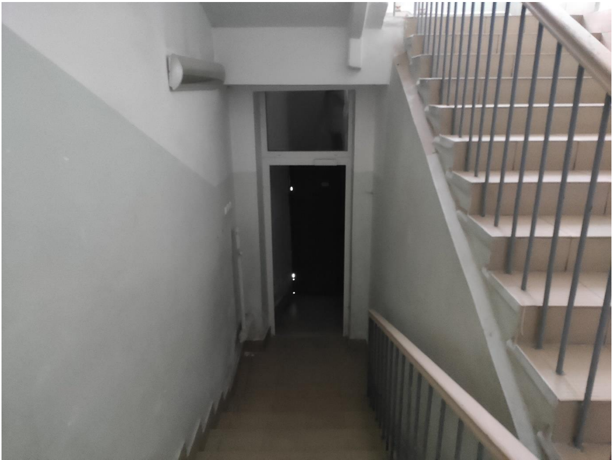
Илл. 157. Лестница в восточном объеме здания.
