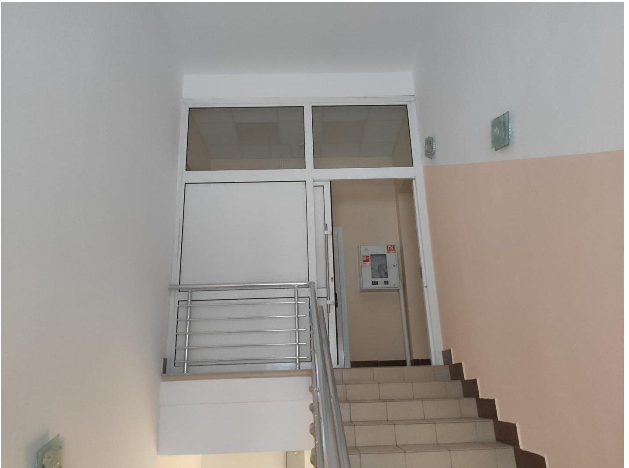
Илл. 110. Лестничная площадка 3 этажа в центральном объеме здания.
