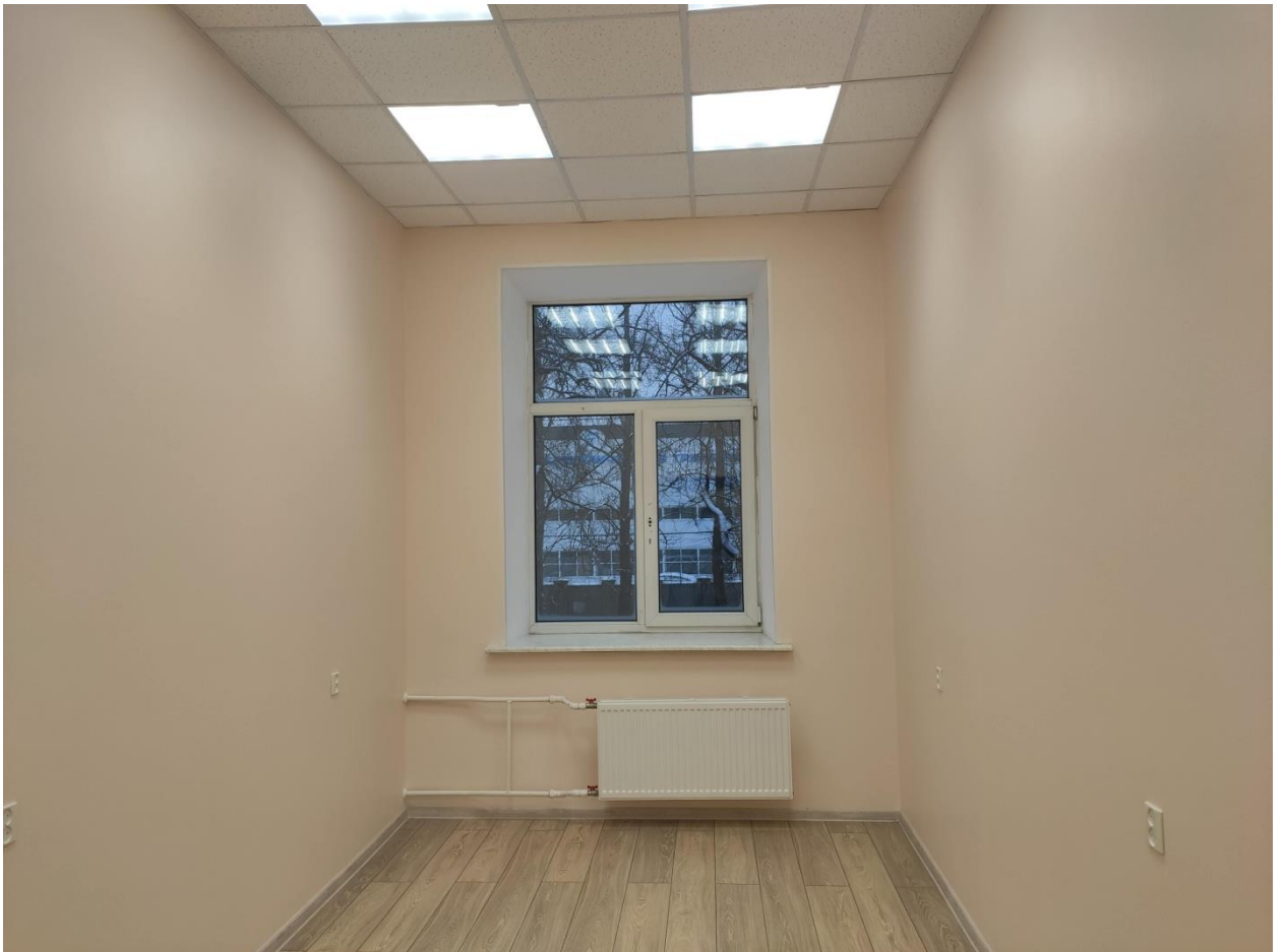
Илл. 103. Помещение 2 этажа в западном объеме здания.
