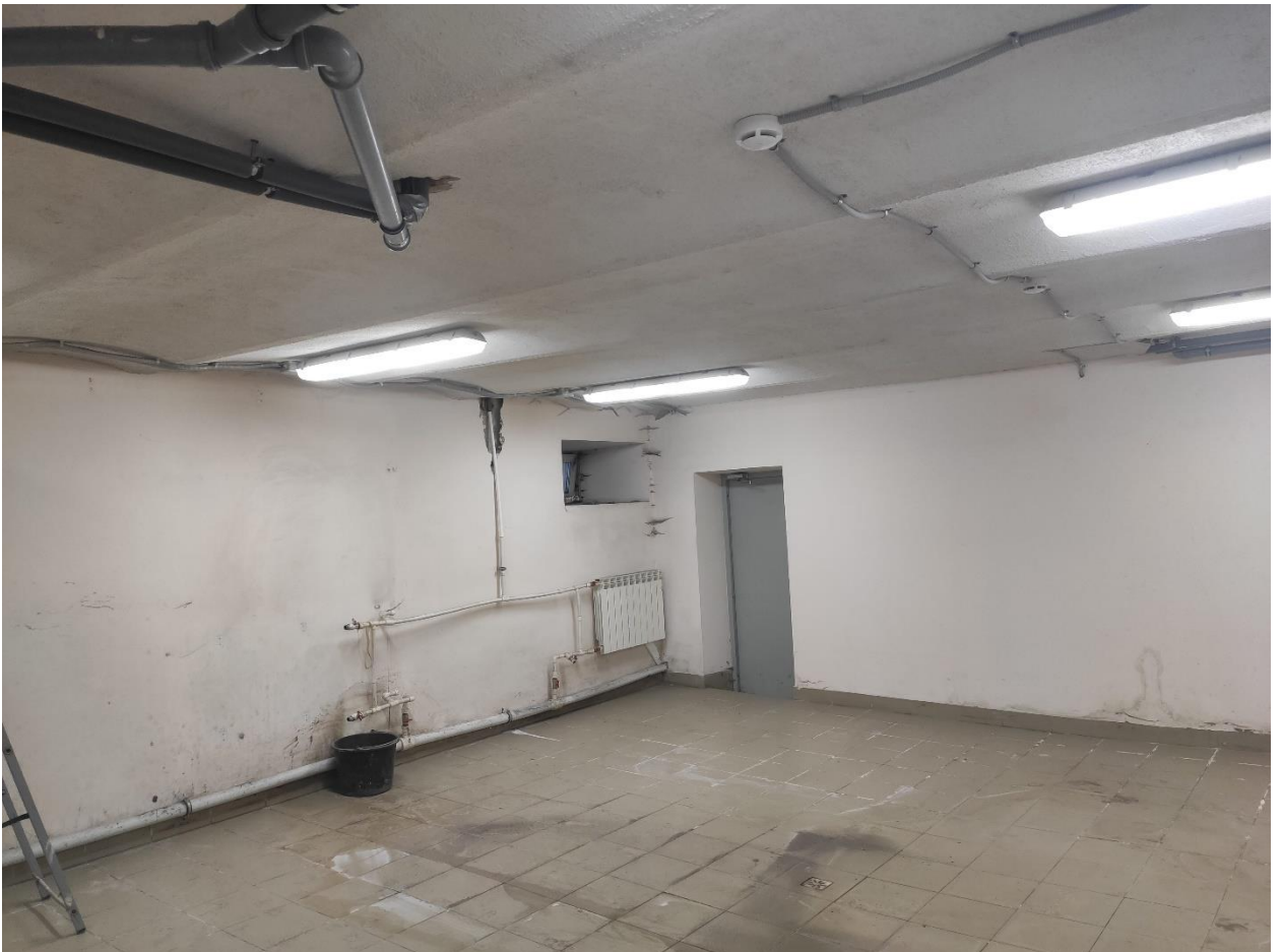
Илл. 31. Подвальное помещение в восточной части здания.
