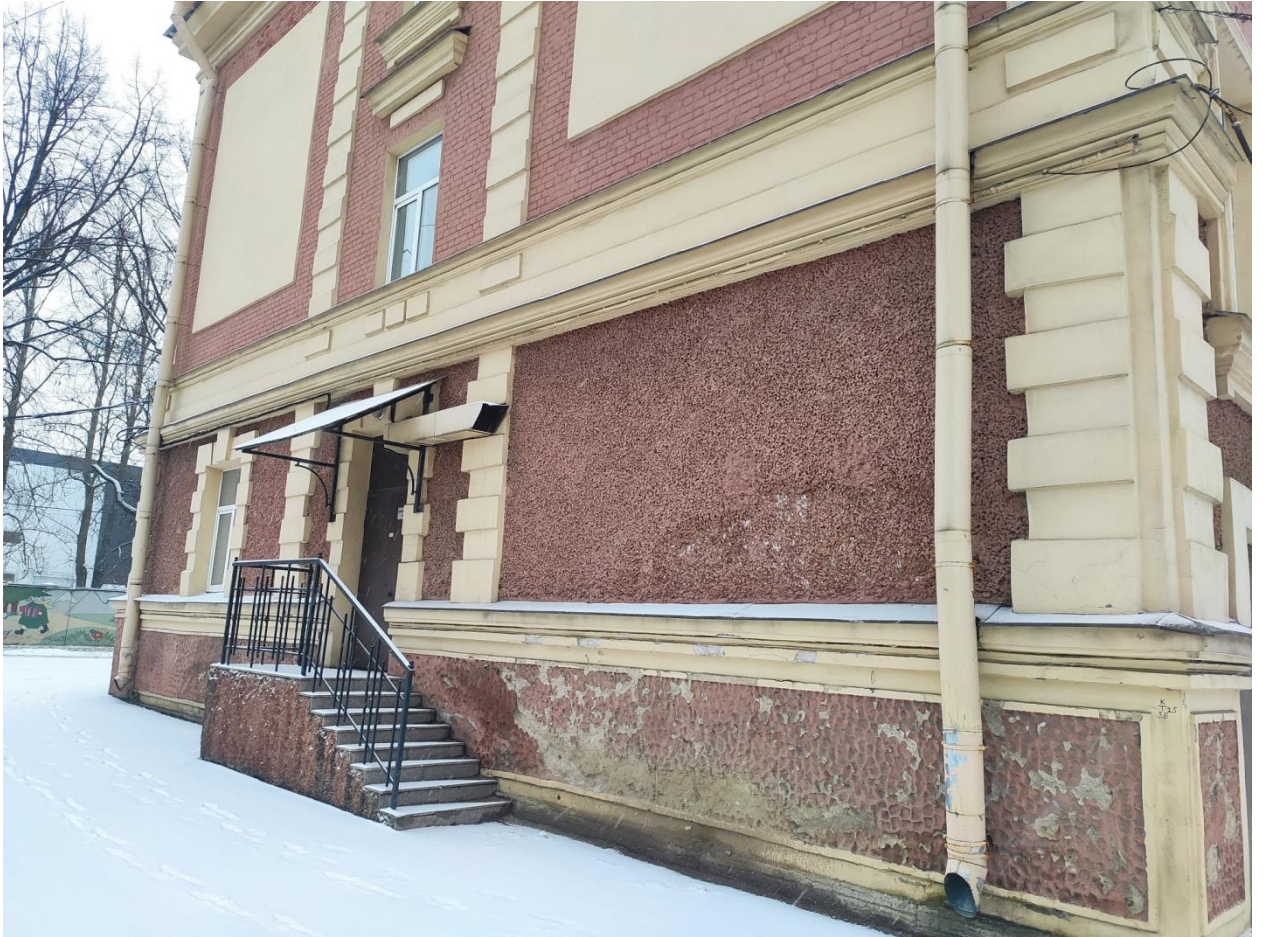
Илл. 7. Торцевой фасад здания.
