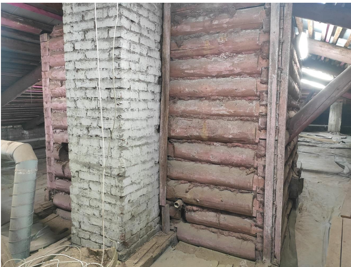
Илл. 164. Помещения чердака.
