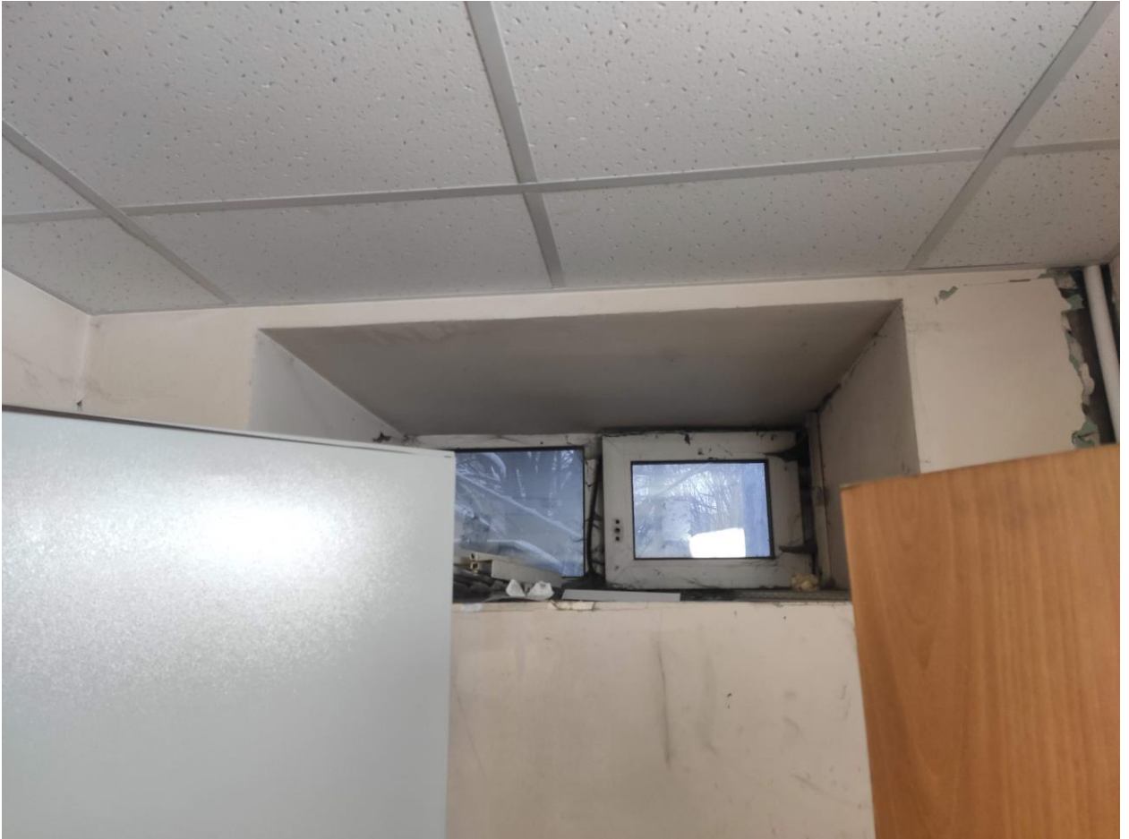
Илл. 36. Окно в подвальном помещении в восточной части здания.
