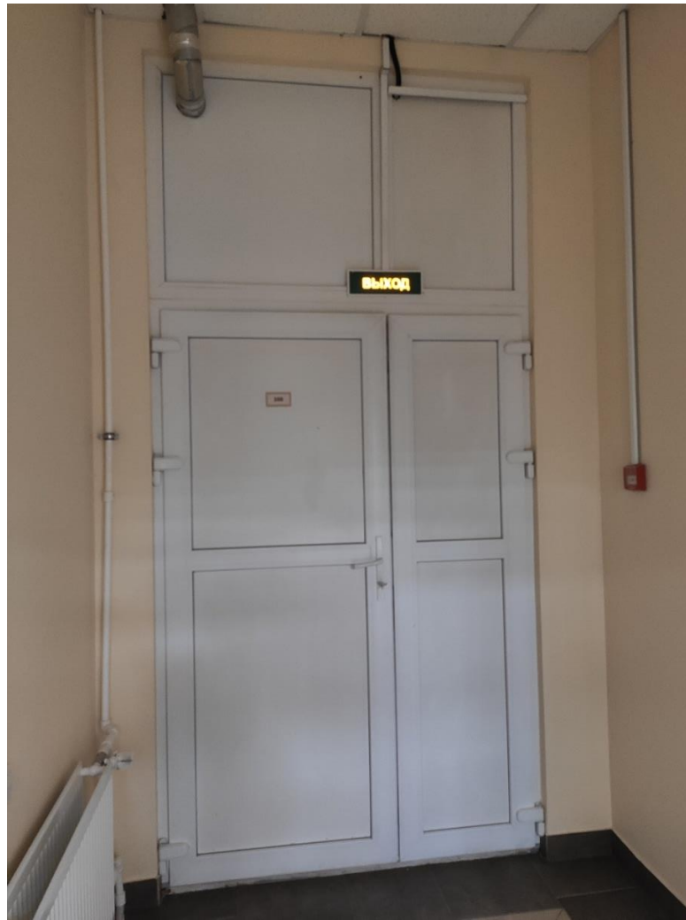
Илл. 50. Выход из коридора 1 этажа в западном объеме здания.
