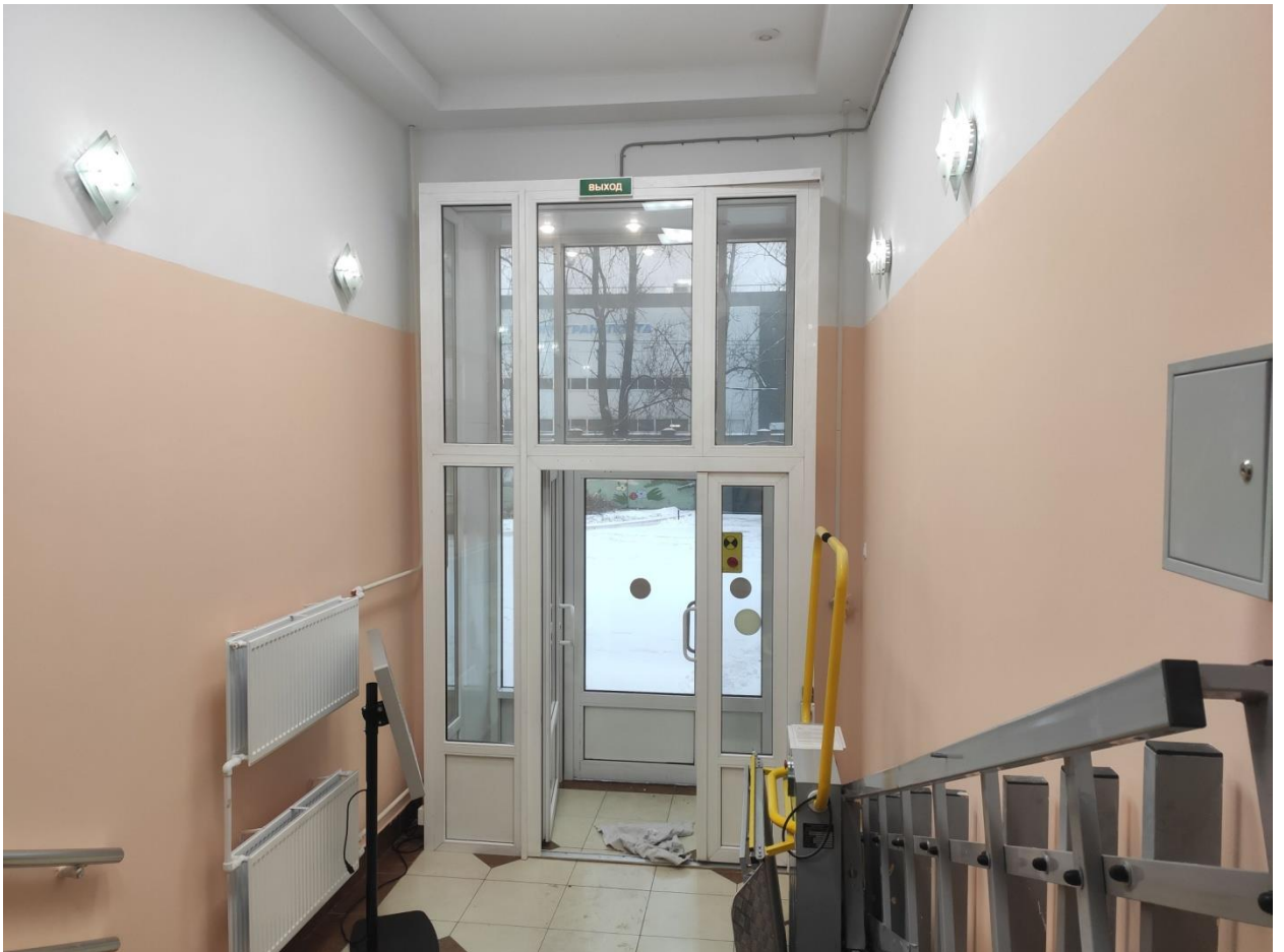
Илл. 39. Главный вход. Вид с лестничной площадки 1 этажа.
