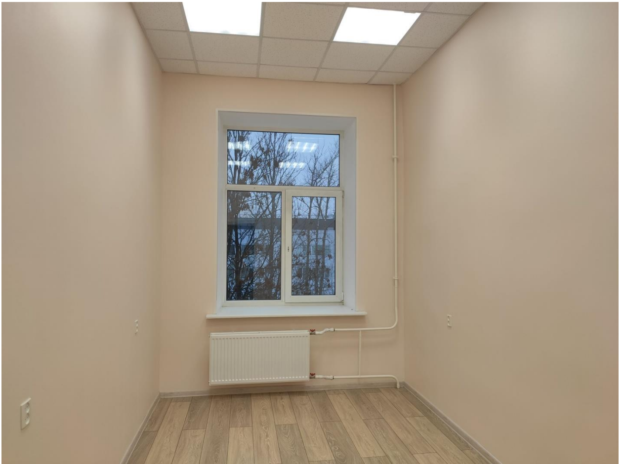
Илл. 120. Помещение 3 этажа в восточном объеме здания.
