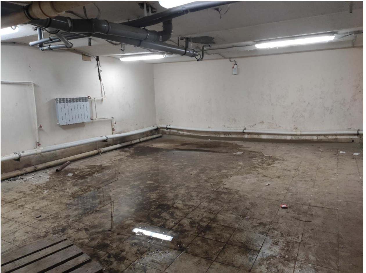
Илл. 24. Подвальное помещение в западной части здания.
