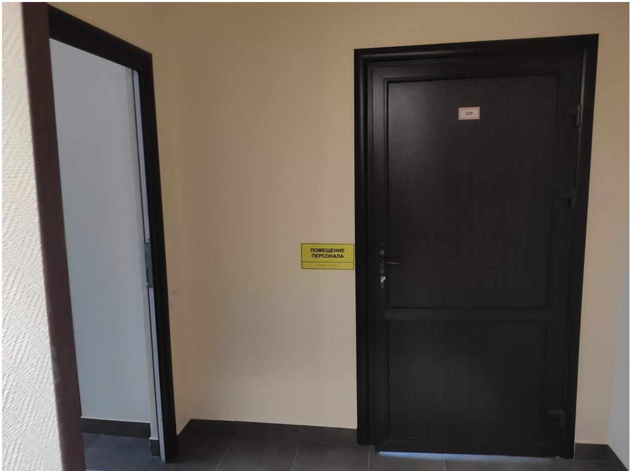
Илл. 66. Помещение 1 этажа в восточном объеме здания.
