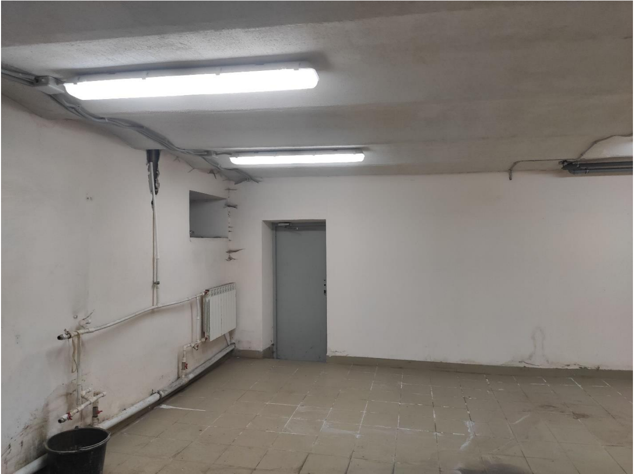
Илл. 32. Фрагмент подвального помещения в восточной части здания.
