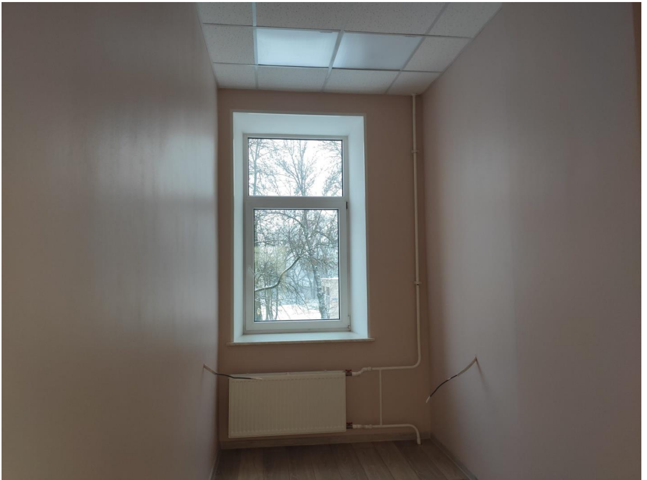
Илл. 81. Помещение 2 этажа в восточном объеме здания.
