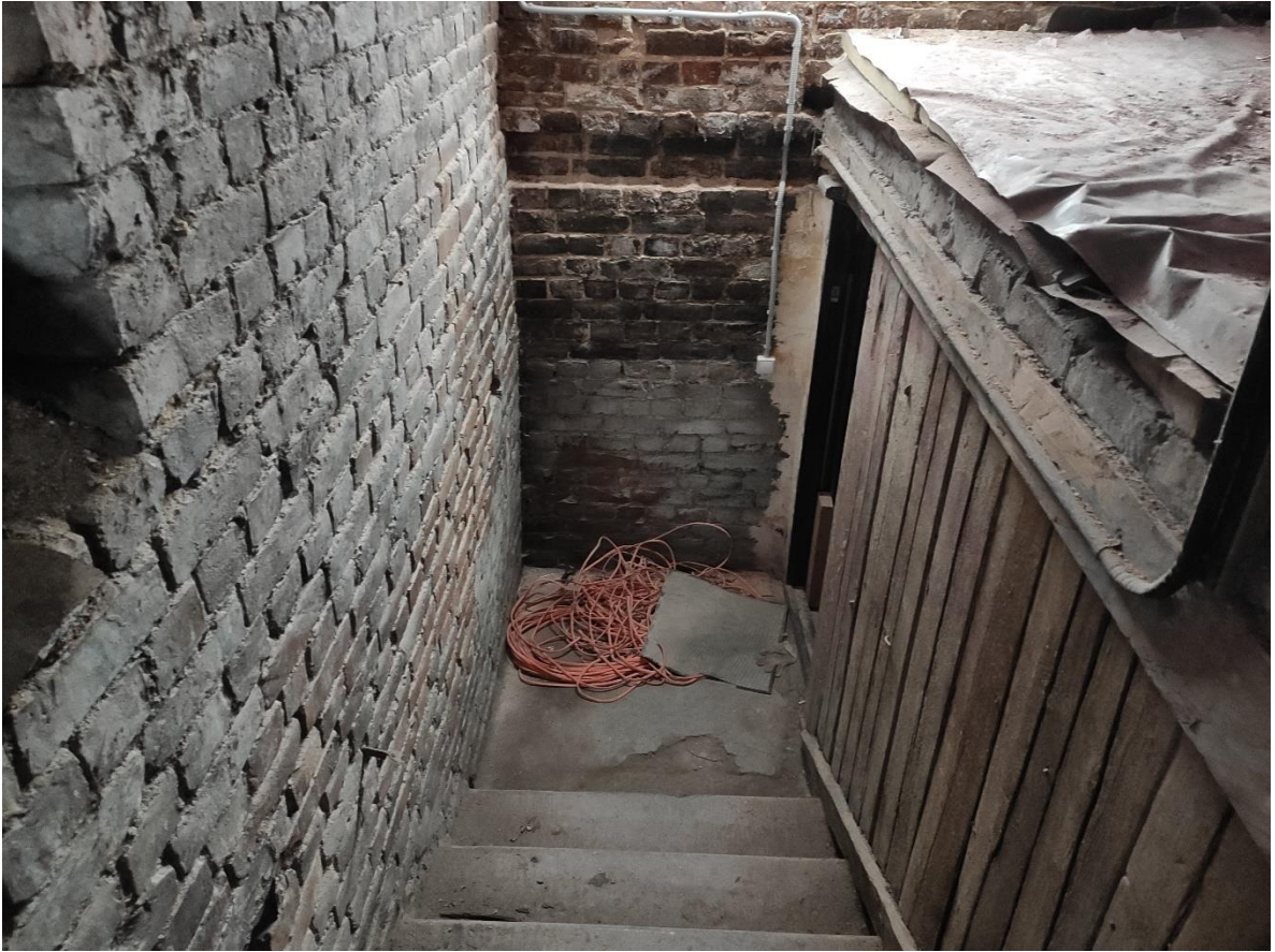
Илл. 171. Помещения чердака.
