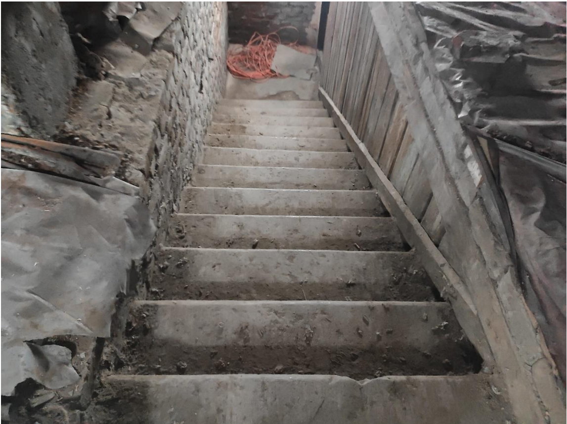
Илл. 170. Помещения чердака.
