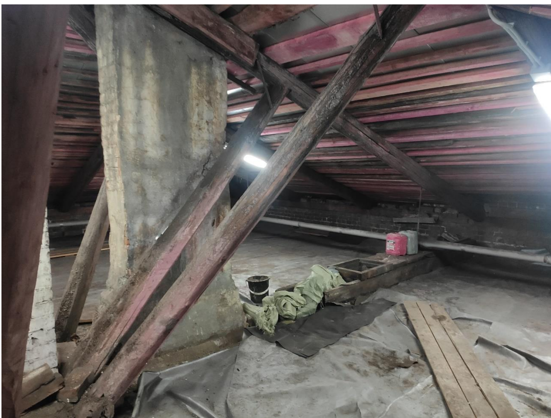
Илл. 166. Помещения чердака.
