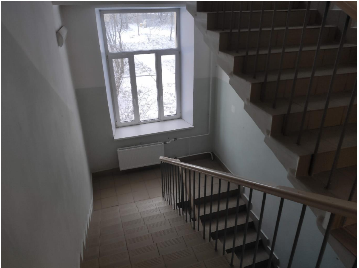
Илл. 159. Лестница в восточном объеме здания.
