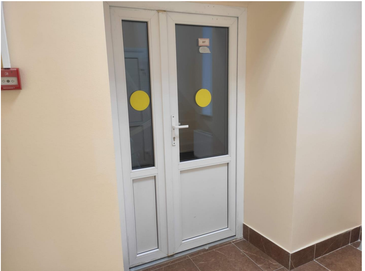
Илл. 100. Дверь в коридоре 2 этажа в западном объеме здания.
