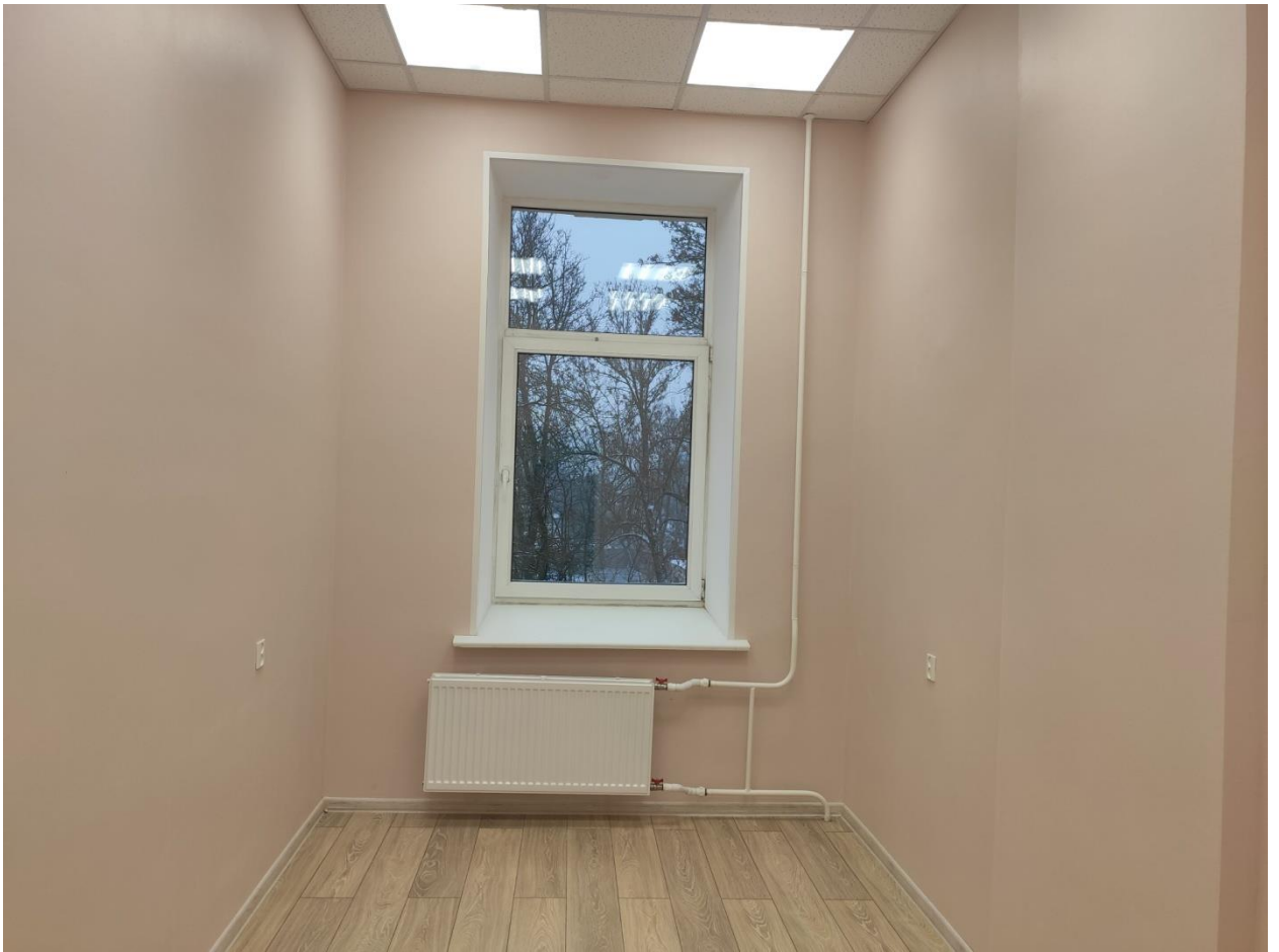
Илл. 112. Помещение 3 этажа в восточном объеме здания.
