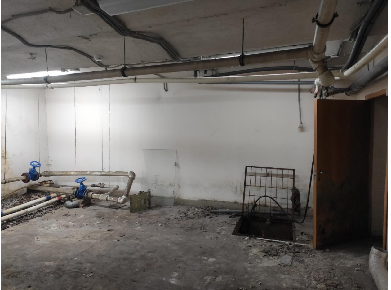
Илл. 28. Фрагмент подвального помещения в восточной части здания.
