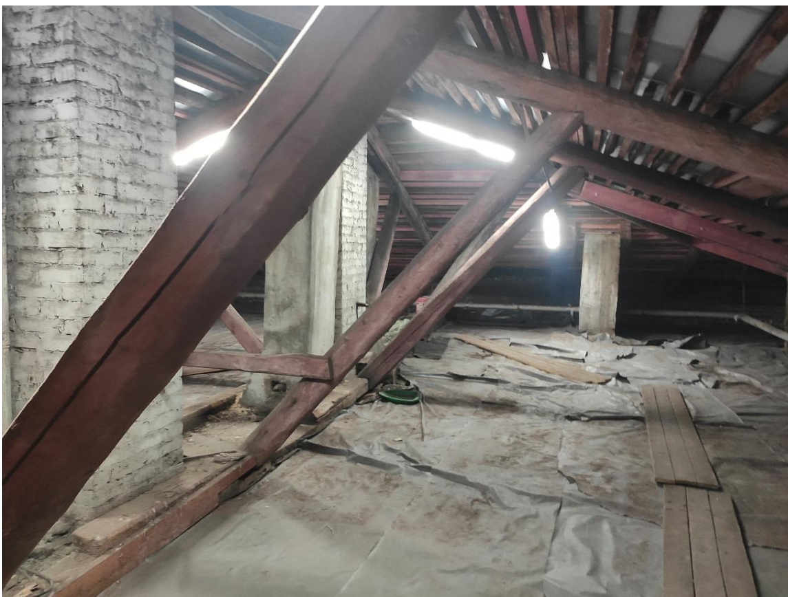
Илл. 165. Помещения чердака.
