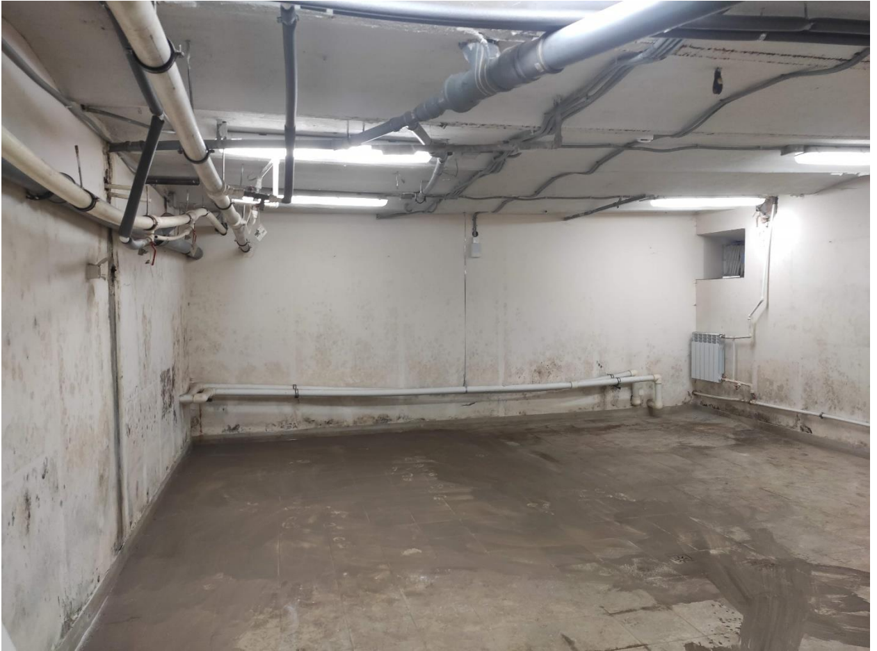
Илл. 22. Часть подвального помещения в западной части здания.
