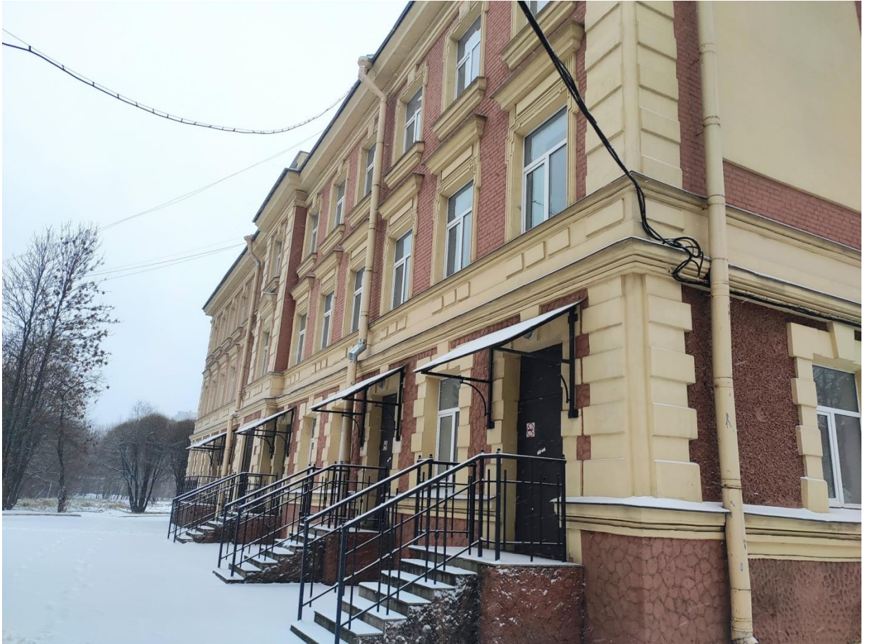
Илл. 5. Лицевой фасад здания.
