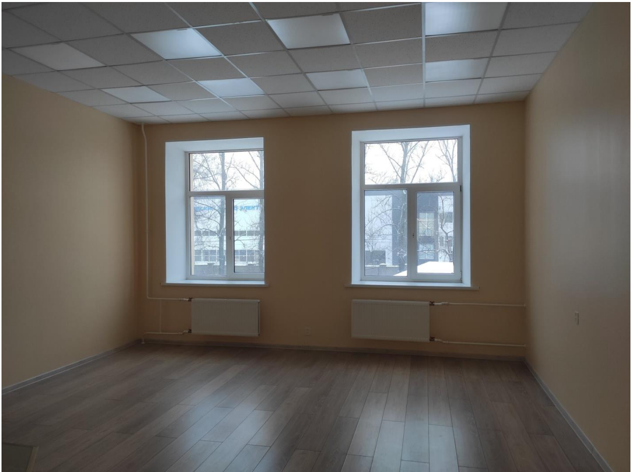
Илл. 91. Помещение 2 этажа в восточном объеме здания.
