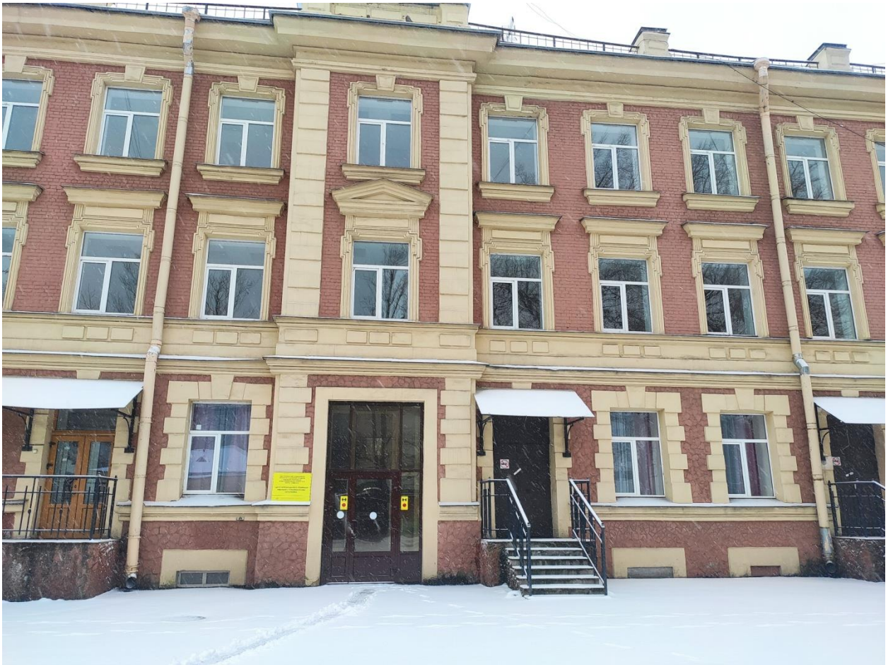
Илл. 3. Лицевой фасад здания.
