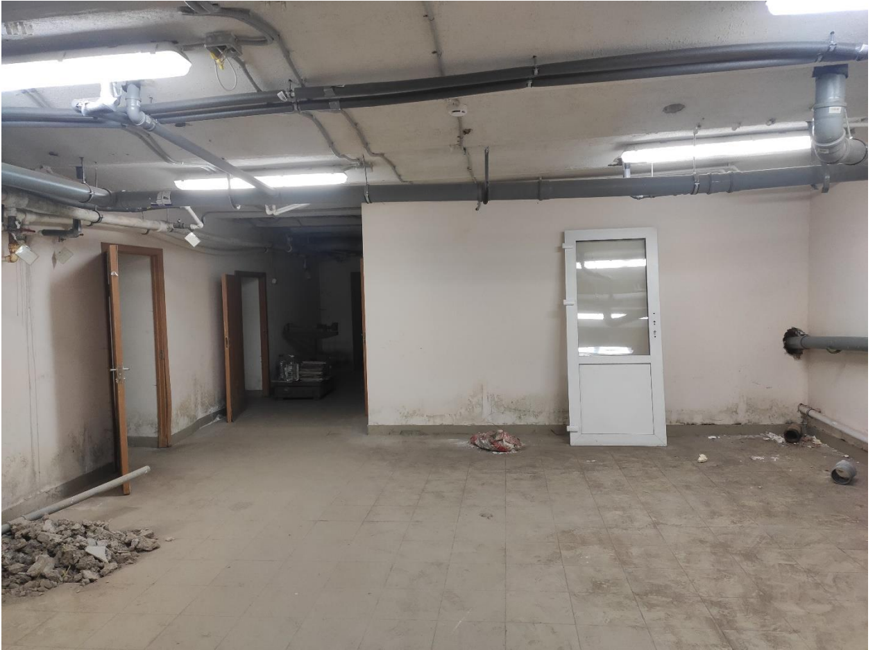
Илл. 20. Фрагмент подвального помещения в западной части здания.
