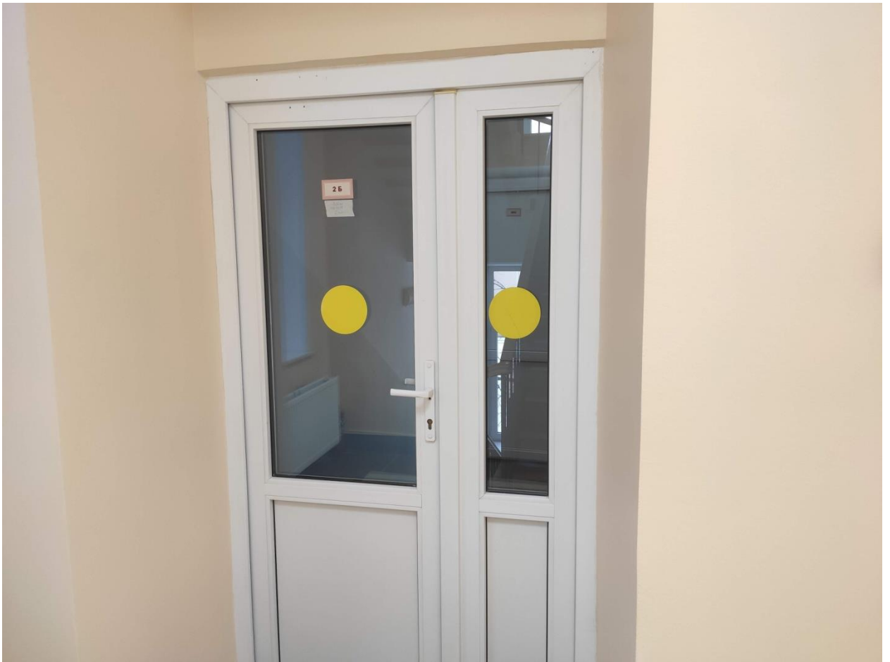
Илл. 87. Дверь в коридоре 2 этажа в восточном объеме здания.
