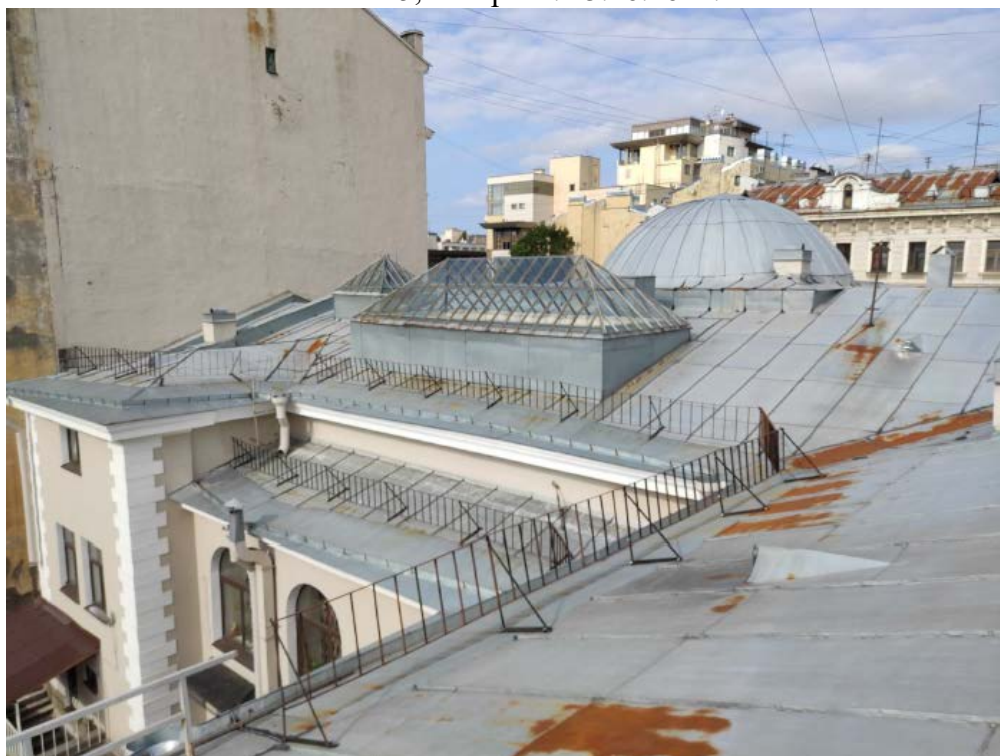
22. Световой фонарь и кровля объекта культурного наследия регионального значения «Быв. дом Белозерского», расположенного по адресу: г. Санкт-Петербург, ул. Куйбышева, д. 25, литера А. 15.10.2021.
