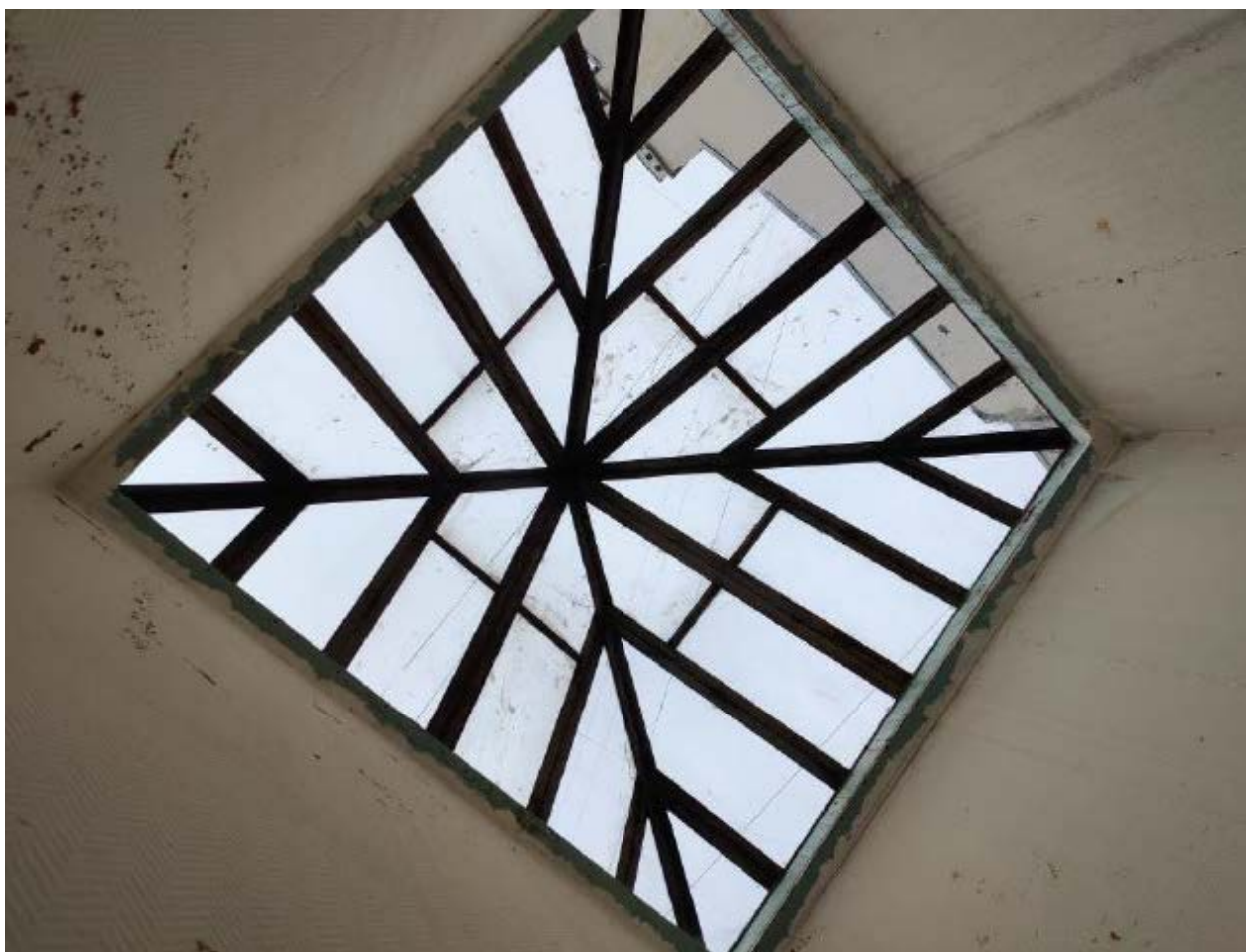
5. Световой фонарь объекта культурного наследия регионального значения «Быв. дом Белозерского», расположенного по адресу: г. Санкт-Петербург, ул. Куйбышева, д. 25, литера А. 15.10.2021
