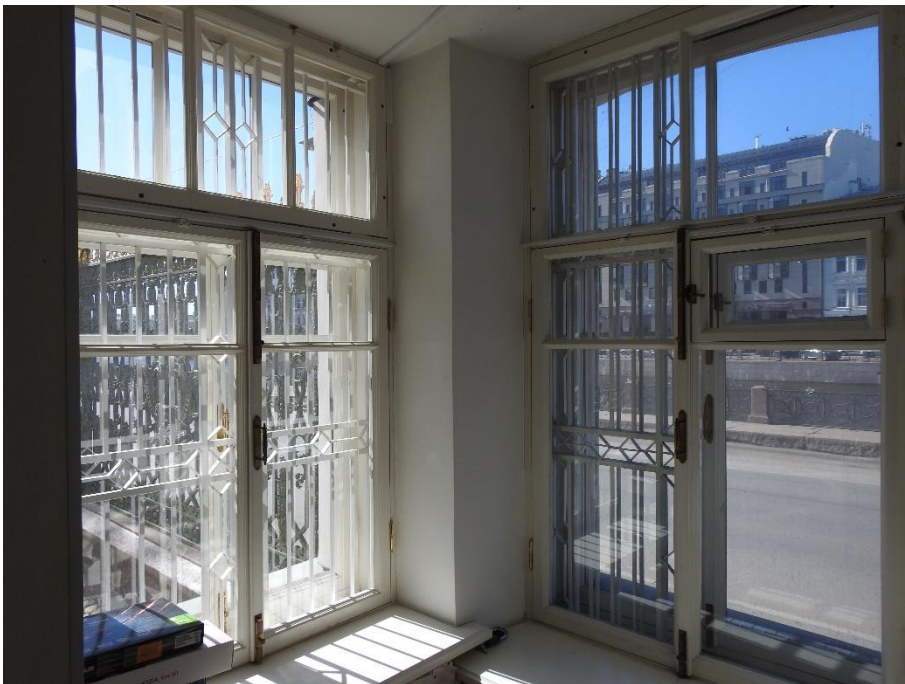
22. «Павильоны (два), 1821-1824 г.г., арх.Квадри Д.И.», входящие в состав объекта культурного наследия федерального значения «Дворец Шереметевых», наб. р. Фонтанки, д. 34, лит. А/Литейный пр., д.51, лит.А. Помещение №5. Фрагмент. Фото 28.03.2022г.
