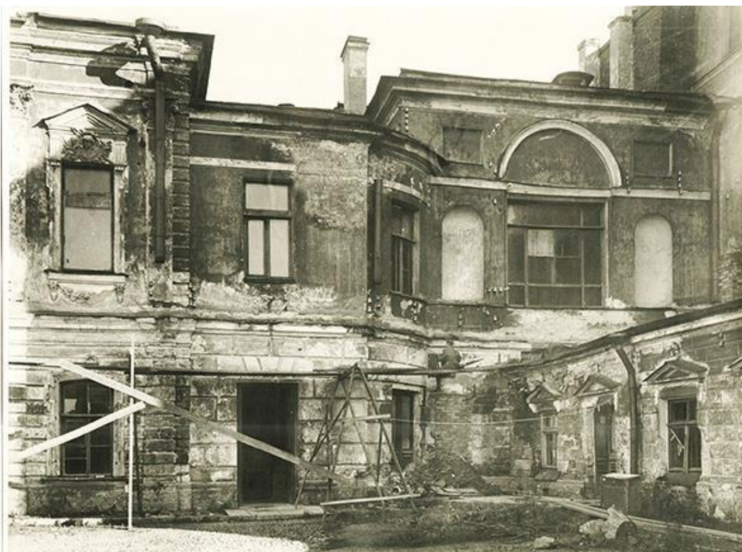
33. Реставрационные работы на фасаде Шереметевского дворца. Ремонт штукатурки и лепного декора на Дуговой комнате и Галерейного флигеля. 1945 г. Архив КГИОП
