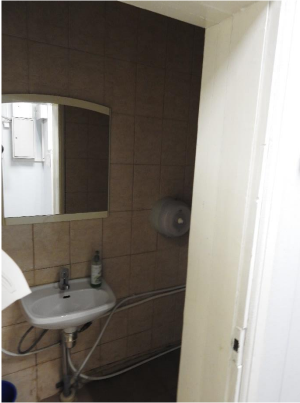
9. «Павильоны (два), 1821-1824 г.г., арх.Квадри Д.И.», входящие в состав объекта культурного наследия федерального значения «Дворец Шереметевых», наб. р. Фонтанки, д. 34, лит. А/Литейный пр., д.51, лит.А. Помещение №2. Общий вид. Фото 28.03.2022г.
