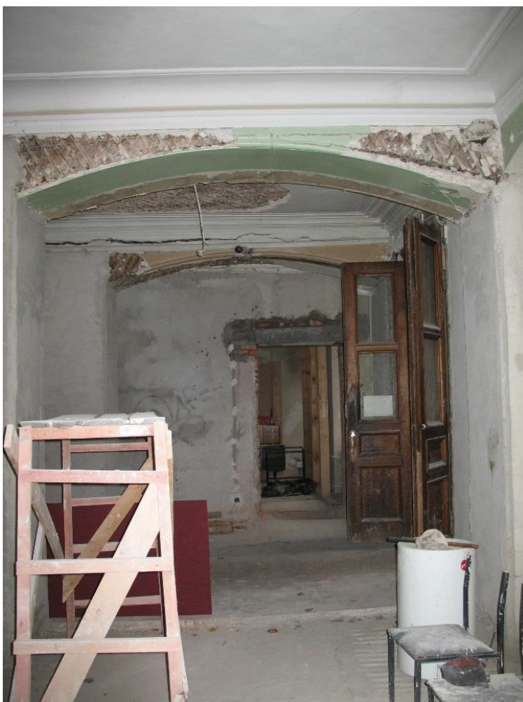
36. Вид из вестибюля. Реставрационные работы 2007г.
