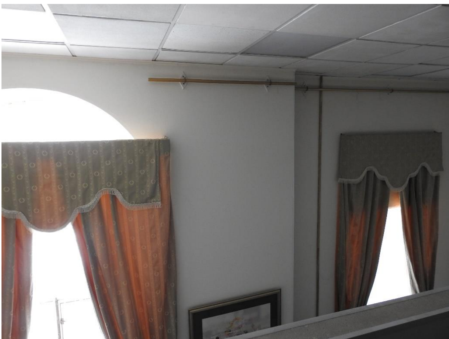
28. «Павильоны (два), 1821-1824 г.г., арх.Квадри Д.И.», входящие в состав объекта культурного наследия федерального значения «Дворец Шереметевых», наб. р. Фонтанки, д. 34, лит. А/Литейный пр., д.51, лит.А. Помещение №6. Фрагмент. Фото 28.03.2022г.
