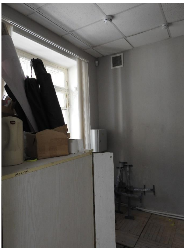
12. «Павильоны (два), 1821-1824 г.г., арх.Квадри Д.И.», входящие в состав объекта культурного наследия федерального значения «Дворец Шереметевых», наб. р. Фонтанки, д. 34, лит. А/Литейный пр., д.51, лит.А. Помещение №3. Общий вид. Фото 28.03.2022г.
