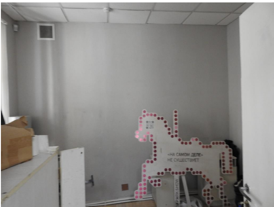
11. «Павильоны (два), 1821-1824 г.г., арх.Квадри Д.И.», входящие в состав объекта культурного наследия федерального значения «Дворец Шереметевых», наб. р. Фонтанки, д. 34, лит. А/Литейный пр., д.51, лит.А. Помещение №3. Общий вид. Фото 28.03.2022г.
