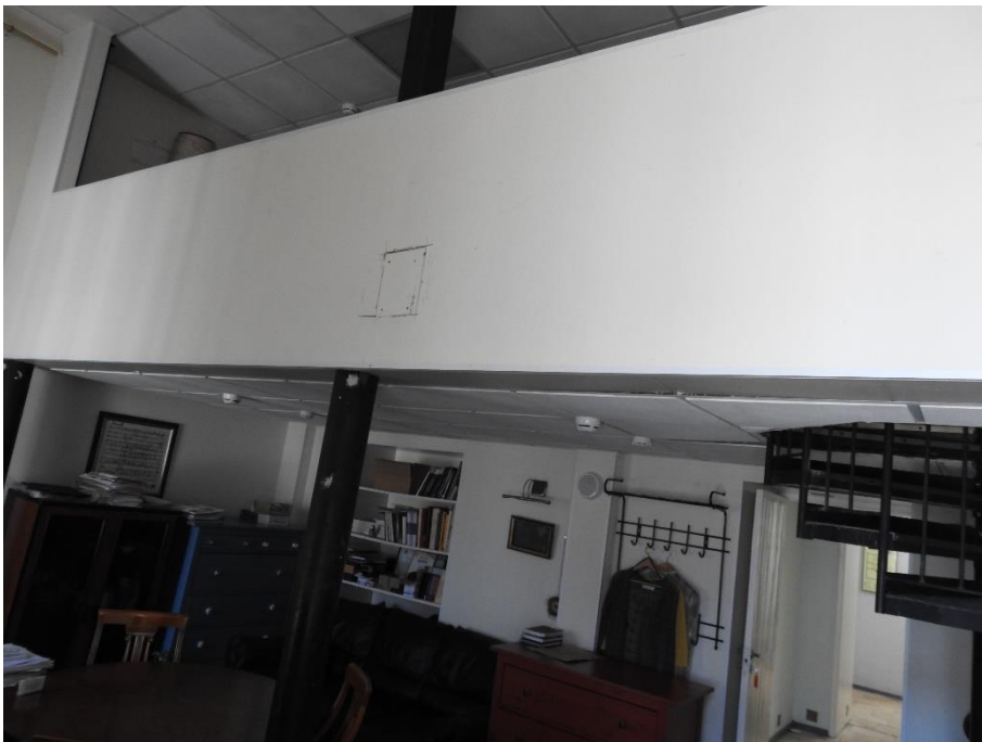
26. «Павильоны (два), 1821-1824 г.г., арх.Квадри Д.И.», входящие в состав объекта культурного наследия федерального значения «Дворец Шереметевых», наб. р. Фонтанки, д. 34, лит. А/Литейный пр., д.51, лит.А. Помещение №6. Фрагмент. Фото 28.03.2022г.
