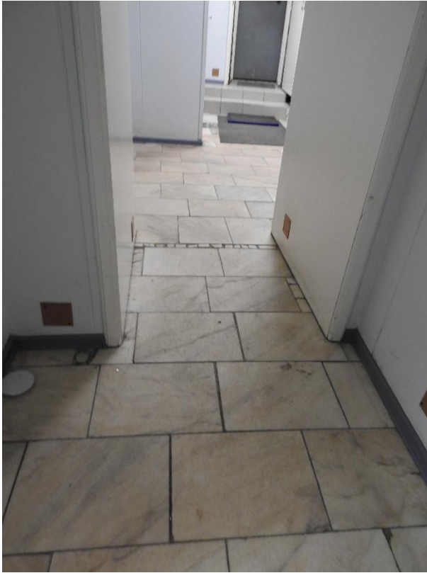
17. «Павильоны (два), 1821-1824 г.г., арх.Квадри Д.И.», входящие в состав объекта культурного наследия федерального значения «Дворец Шереметевых», наб. р. Фонтанки, д. 34, лит. А/Литейный пр., д.51, лит.А. Помещение №8. Фрагмент. Фото 28.03.2022г.
