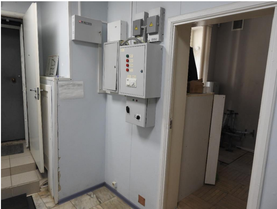
7. «Павильоны (два), 1821-1824 г.г., арх.Квадри Д.И.», входящие в состав объекта культурного наследия федерального значения «Дворец Шереметевых», наб. р. Фонтанки, д. 34, лит. А/Литейный пр., д.51, лит.А. Помещение №1. Фрагмент. Фото 28.03.2022г.
