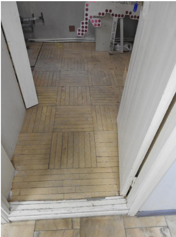
13. «Павильоны (два), 1821-1824 г.г., арх.Квадри Д.И.», входящие в состав объекта культурного наследия федерального значения «Дворец Шереметевых», наб. р. Фонтанки, д. 34, лит. А/Литейный пр., д.51, лит.А. Помещение №3. Фрагмент. Фото 28.03.2022г.
