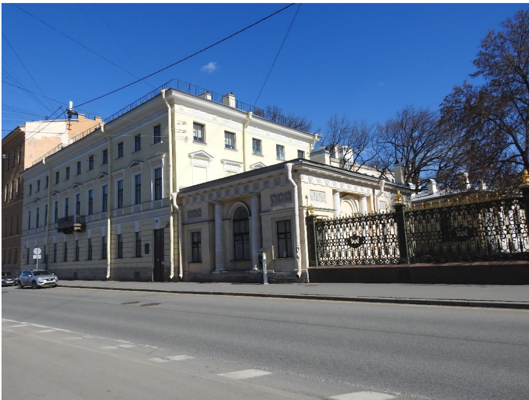
5. «Павильоны (два), 1821-1824 г.г., арх.Квадри Д.И.», входящие в состав объекта культурного наследия федерального значения «Дворец Шереметевых», наб. р. Фонтанки, д. 34, лит. А/Литейный пр., д.51, лит.А. Павильон. Общий вид с запада. Фото 28.03.2022г.
