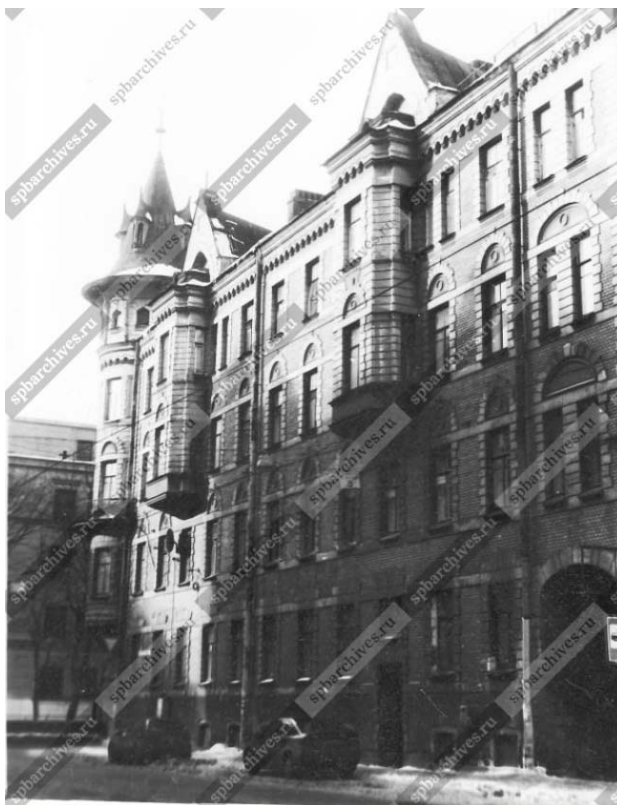
Илл. 23. Вид главного фасада дома № 33 на Большой Зелениной улице. Архитектор Г.Г. фон Голи, 1899 - 1901 гг. Автор съёмки: Овчинников Кирилл Владимирович. Дата съёмки: 08.11.1984 г.// ЦГАКФФД СПб. Шифр: Ар 211555.
