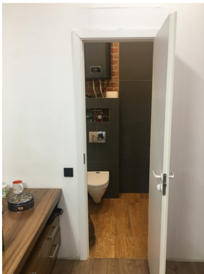
32. Выявленный объект культурного наследия «Дом А.Ю. Кейбеля» по адресу: г. Санкт-Петербург, Большая Зеленина ул., 33; Барочная ул., 2, литера А, квартира № 27 А. Санузел.
