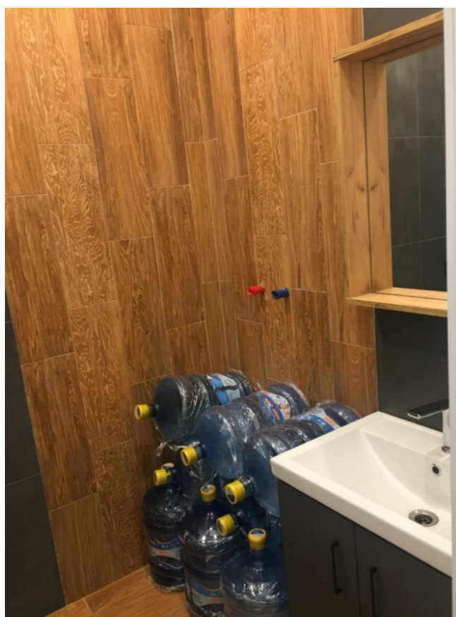
12. Выявленный объект культурного наследия «Дом А.Ю. Кейбеля» по адресу: г. Санкт-Петербург, Большая Зеленина ул., 33; Барочная ул., 2, квартира № 27 А. Санузел.
