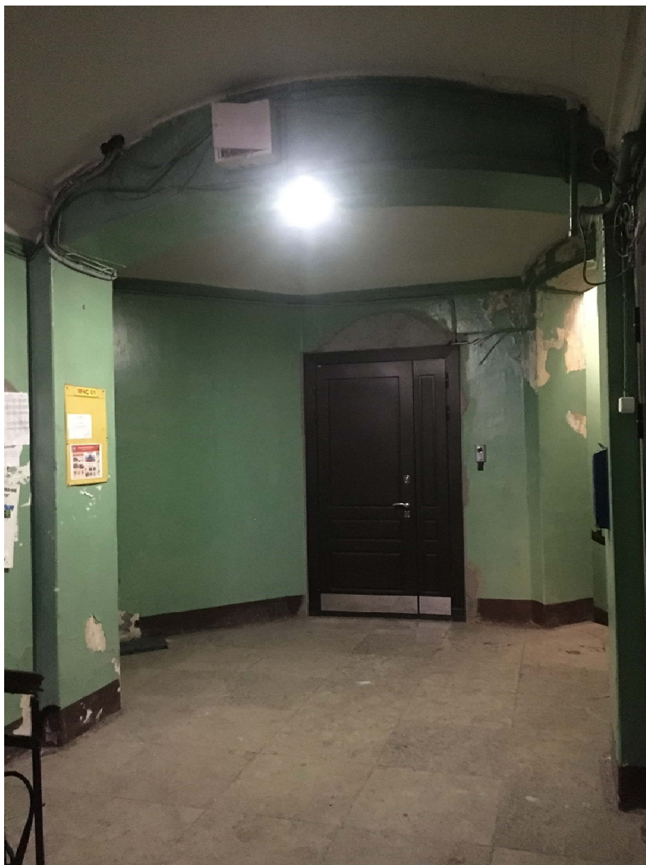
8. Вид парадной выявленного объекта культурного наследия «Дом А.Ю. Кейбеля» по адресу: г. Санкт-Петербург, Большая Зеленина ул., 33; Барочная ул., 2. Вход в квартиру № 27 А.
