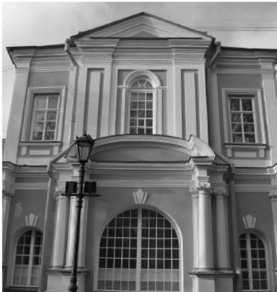
Фото 27. ОКН федерального значения «Корпус просфорный с северными воротами главного двора» (наб. реки Монастырки, дом 1, литера Г). Южный фасад. Фрагмент. Съёмка 27.09.2021 г.
