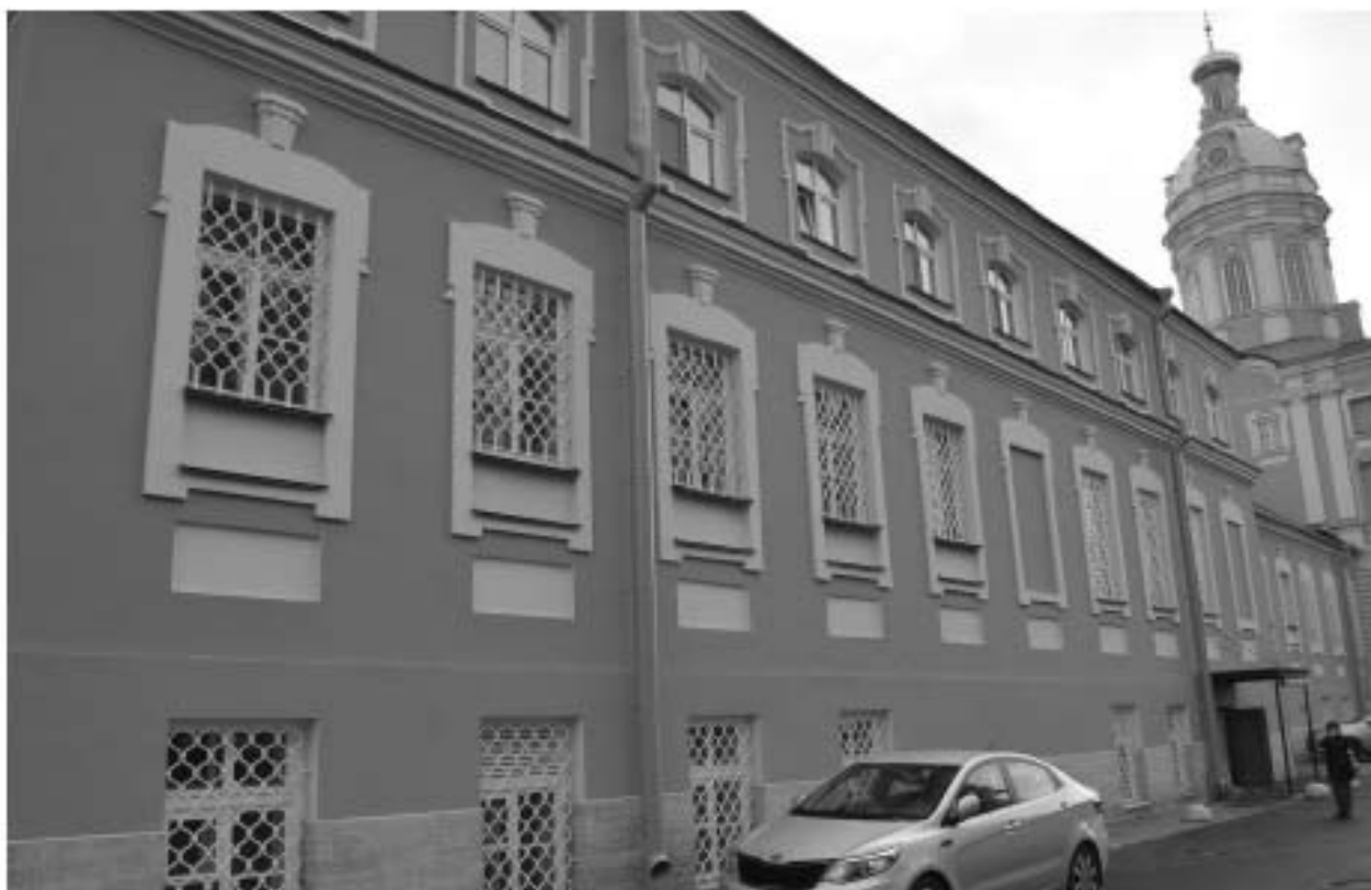
Фото 33. ОКН федерального значения «Корпус просфорный с северными воротами главного двора» (наб. реки Монастырки, дом 1, литера Г). Северный фасад. Фрагмент. Съёмка 27.09.2021 г.
