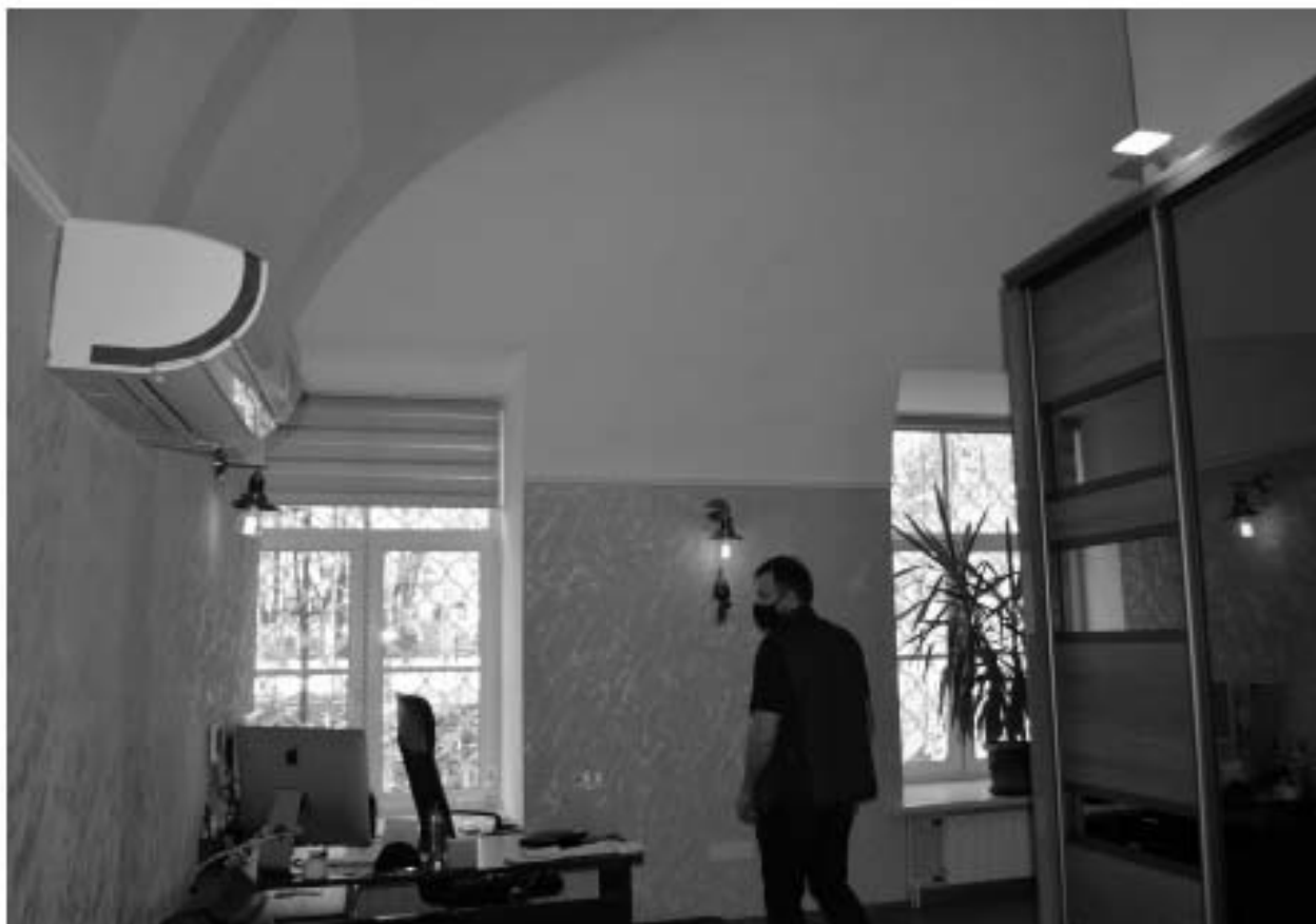
Фото 09. ОКН федерального значения «Корпус просфорный с северными воротами главного двора» (наб. реки Монастырки, дом 1, литера Г). Галерея первого этажа в осях Б-Г/4-5. Съёмка 27.09.2021 г.
