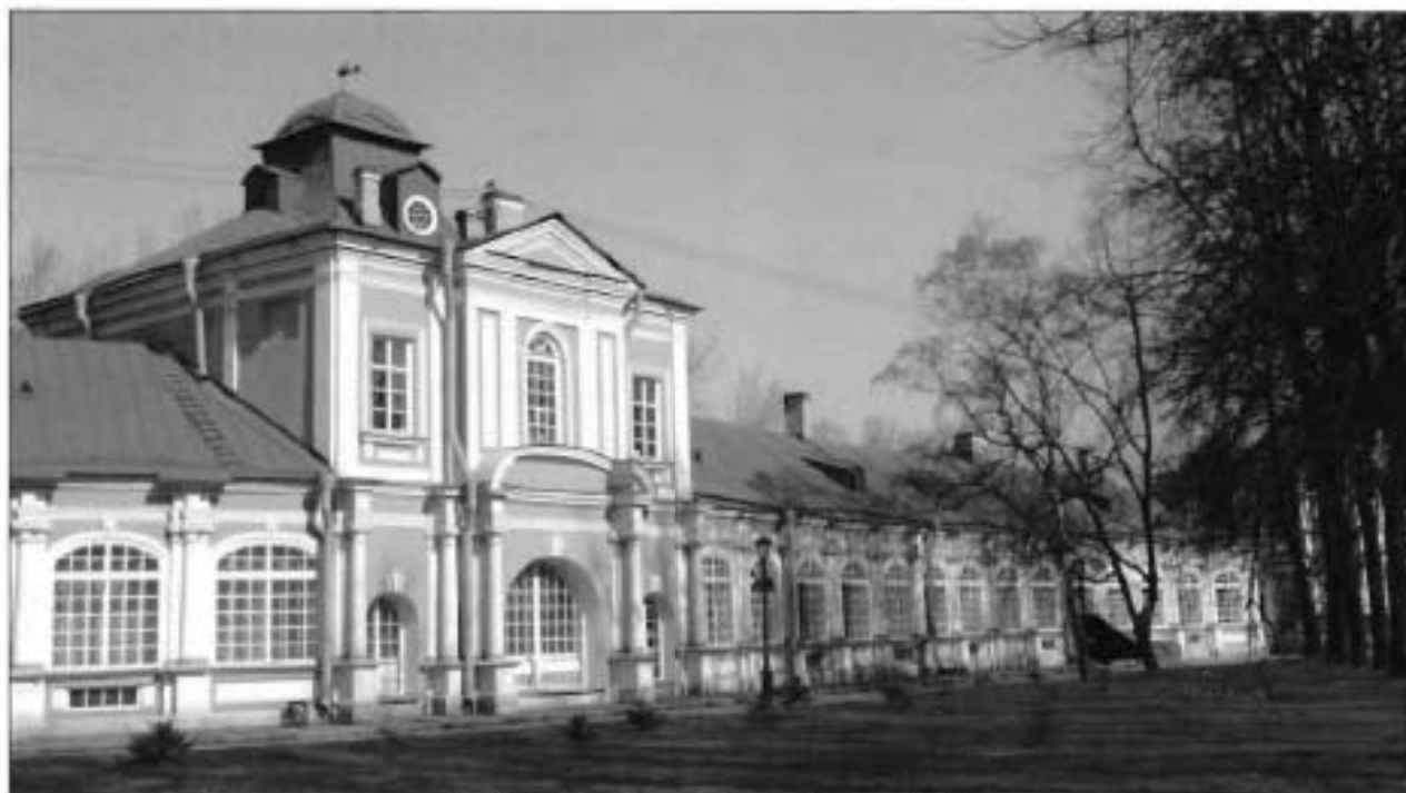
3. Южный фасад. Восточная часть.
