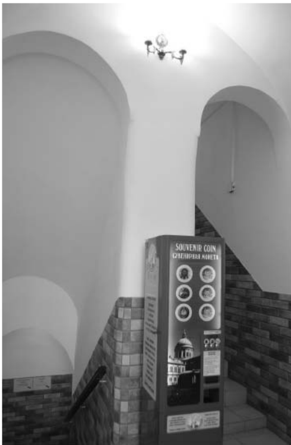
Фото 02. ОКН федерального значения «Корпус просфорный с северными воротами главного двора» (наб. реки Монастырки, дом 1, литера Г). Межэтажная площадка в осях Б-Г/4-5. Съёмка 27.09.2021 г.
