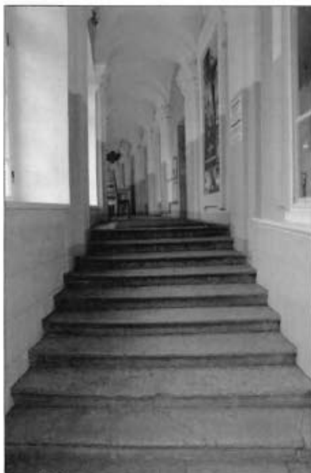
7. Галерея в уровне первого этажа.
