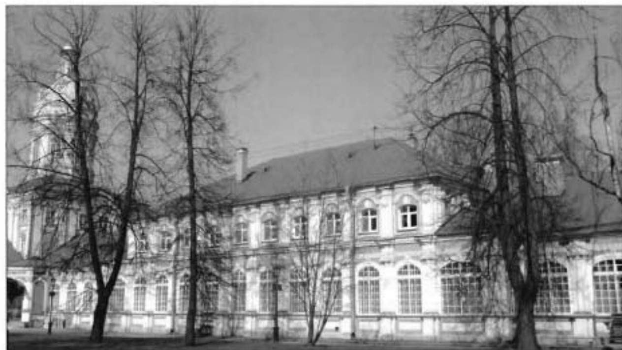
4. Южный фасад. Западная часть.
