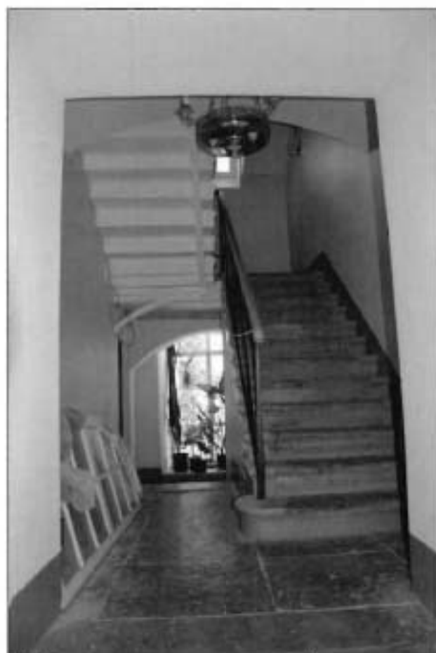
8. Лестница в северо-восточной части здания.
