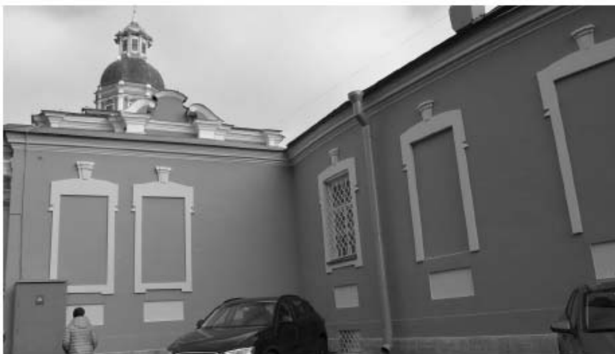
Фото 30. ОКН федерального значения «Корпус просфорный с северными воротами главного двора» (наб. реки Монастырки, дом 1, литера Г). Северный фасад. Фрагмент. Съёмка 27.09.2021 г.
