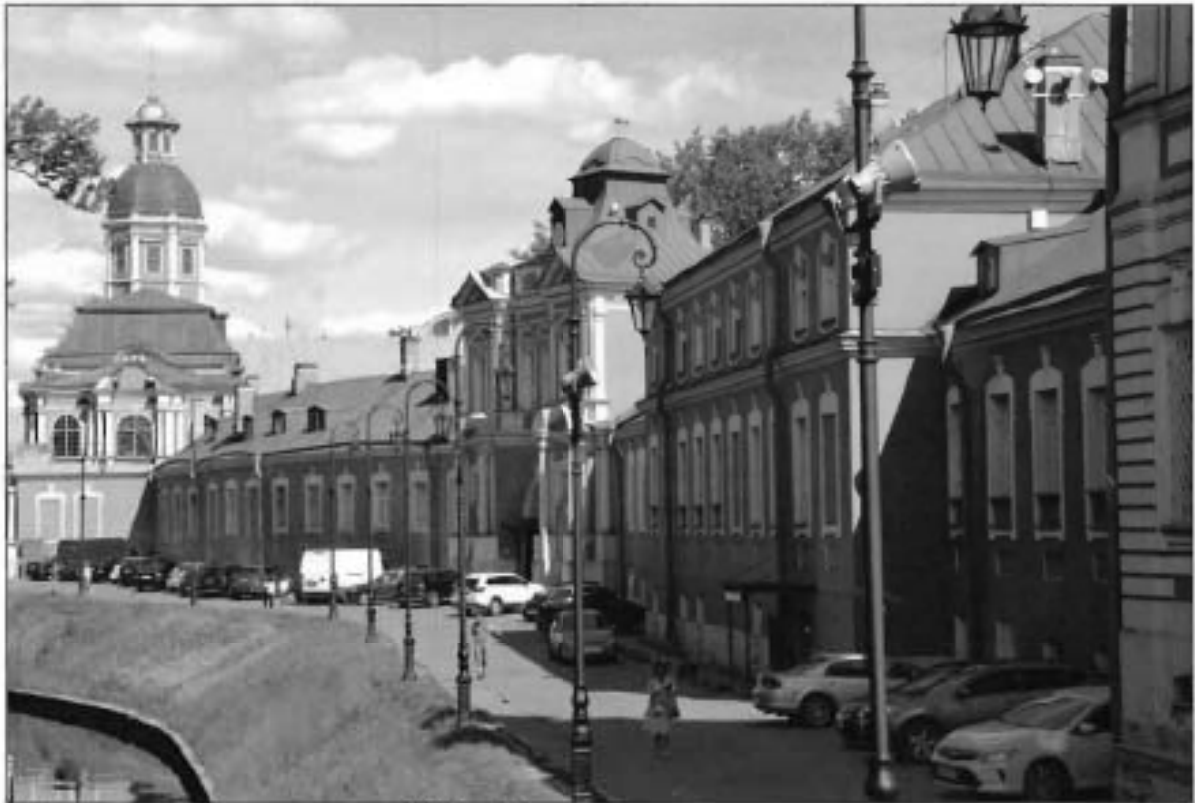
1.Общий вид с северо-запада.
