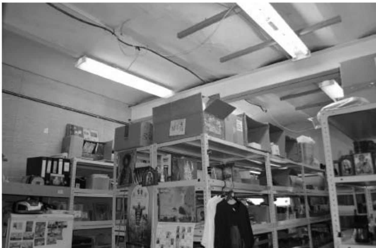
Фото 25. ОКН федерального значения «Корпус просфорный с северными воротами главного двора» (наб. реки Монастырки, дом 1, литера Г). Помещение в осях Б-Г/4-5. Съёмка 27.09.2021 г.
