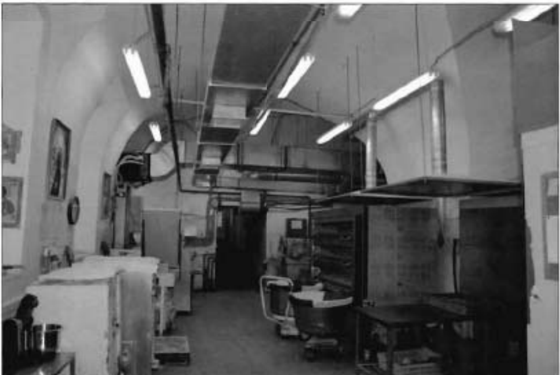
6. Сводчатые перекрытия в уровне цокольного этажа.
