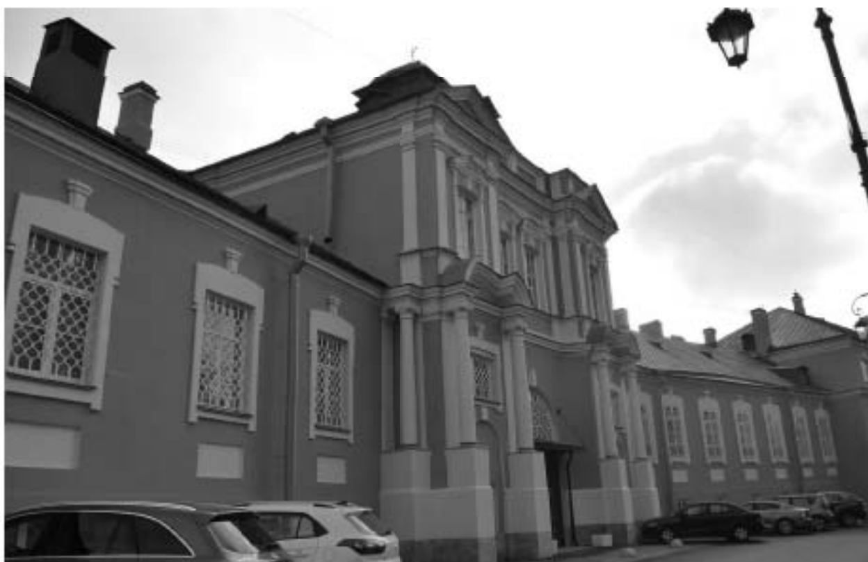
Фото 31. ОКН федерального значения «Корпус просфорный с северными воротами главного двора» (наб. реки Монастырки, дом 1, литера Г). Северный фасад. Фрагмент. Съёмка 27.09.2021 г.
