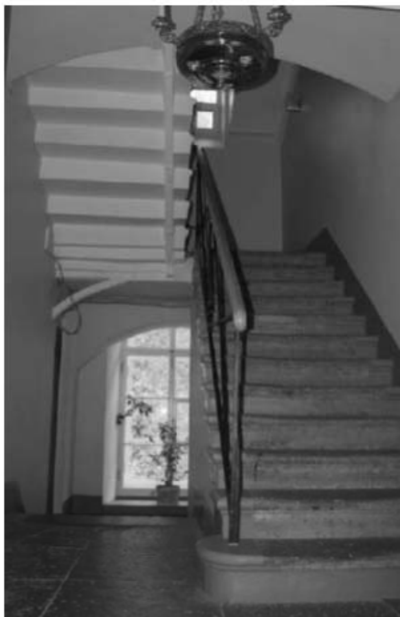
Фото 13. ОКН федерального значения «Корпус просфорный с северными воротами главного двора» (наб. реки Монастырки, дом 1, литера Г). Лестница в осях Е-Ж/7-8. Съемка 27.09.2021 г.
