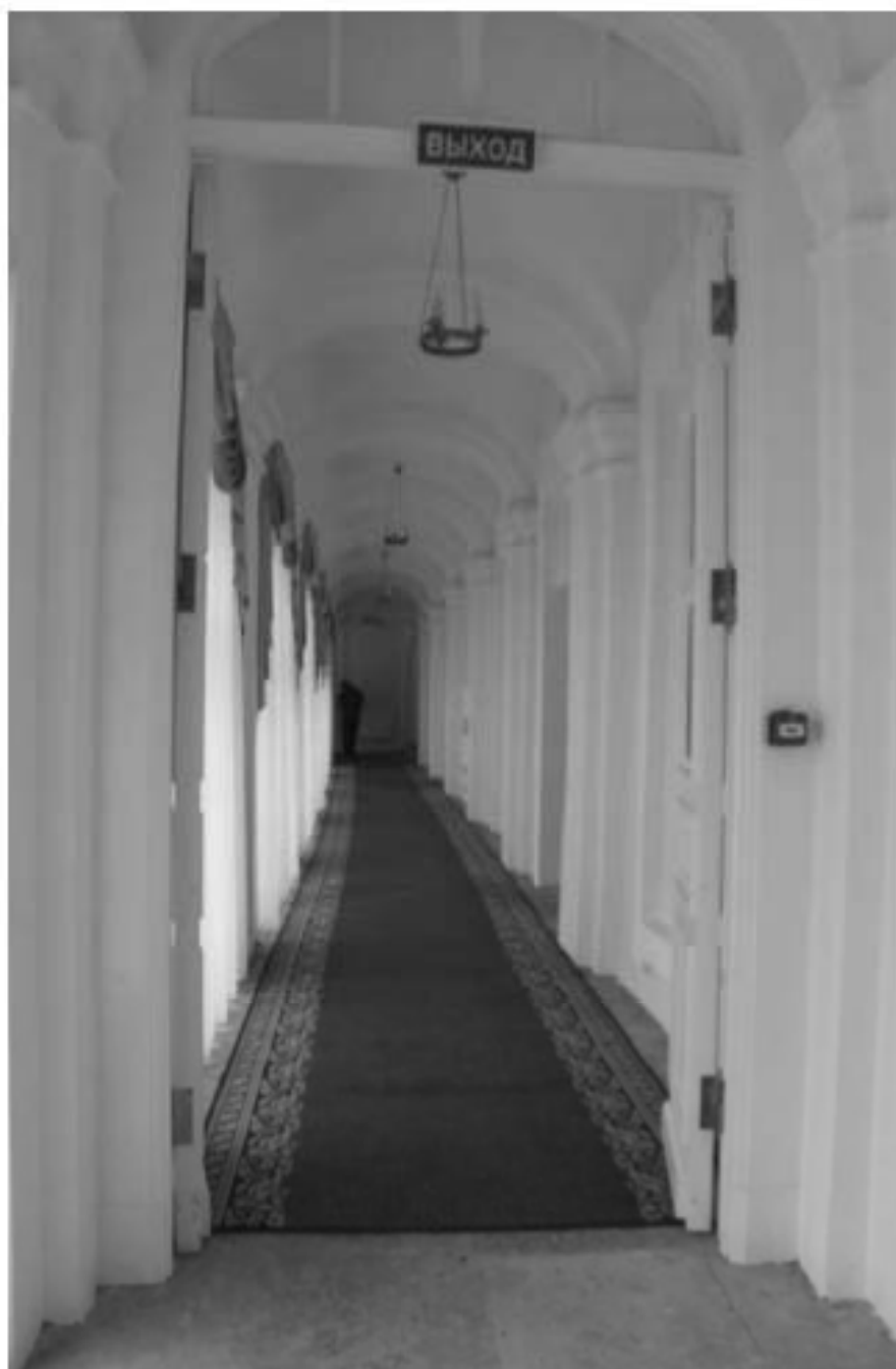
Фото 11. ОКН федерального значения «Корпус просфорный с северными воротами главного двора» (наб. реки Монастырки, дом 1, литера Г). Галерея первого этажа в осях Б-Г/5-6. Съёмка 27.09.2021 г.
