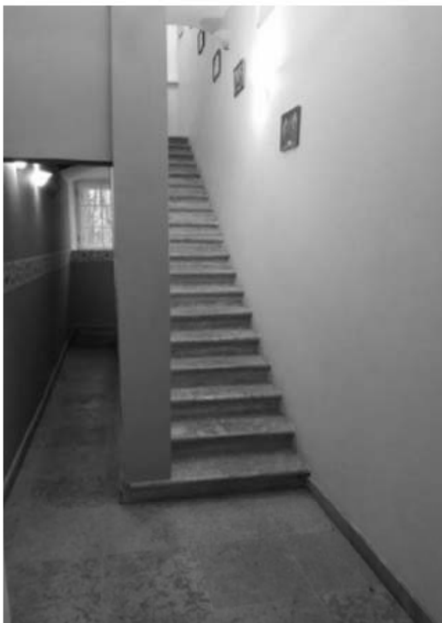
Фото 12. ОКН федерального значения «Корпус просфорный с северными воротами главного двора» (наб. реки Монастырки, дом 1, литера Г). Лестница в осях Б-Г/5-6. Съёмка 27.09.2021 г.
