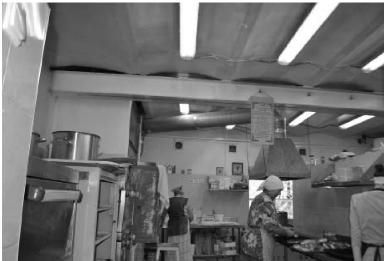
Фото 23. ОКН федерального значения «Корпус просфорный с северными воротами главного двора» (наб. реки Монастырки, дом 1, литера Г). Помещение в осях Б-Г/4-5. Съёмка 27.09.2021 г.
