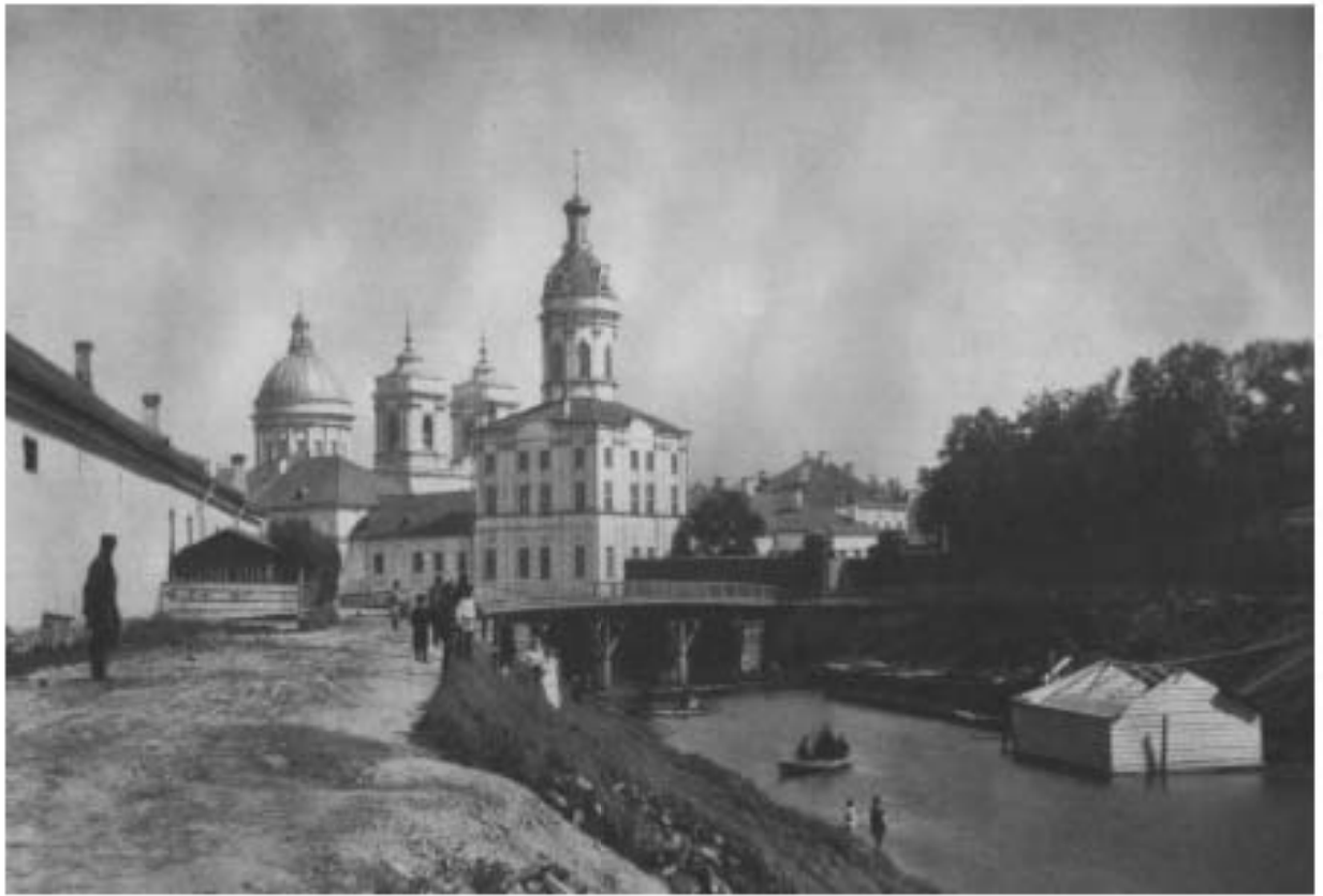
Илл. 1. Северо-Западная башня и часть Просфорного корпуса. 1880–1890 гг.
