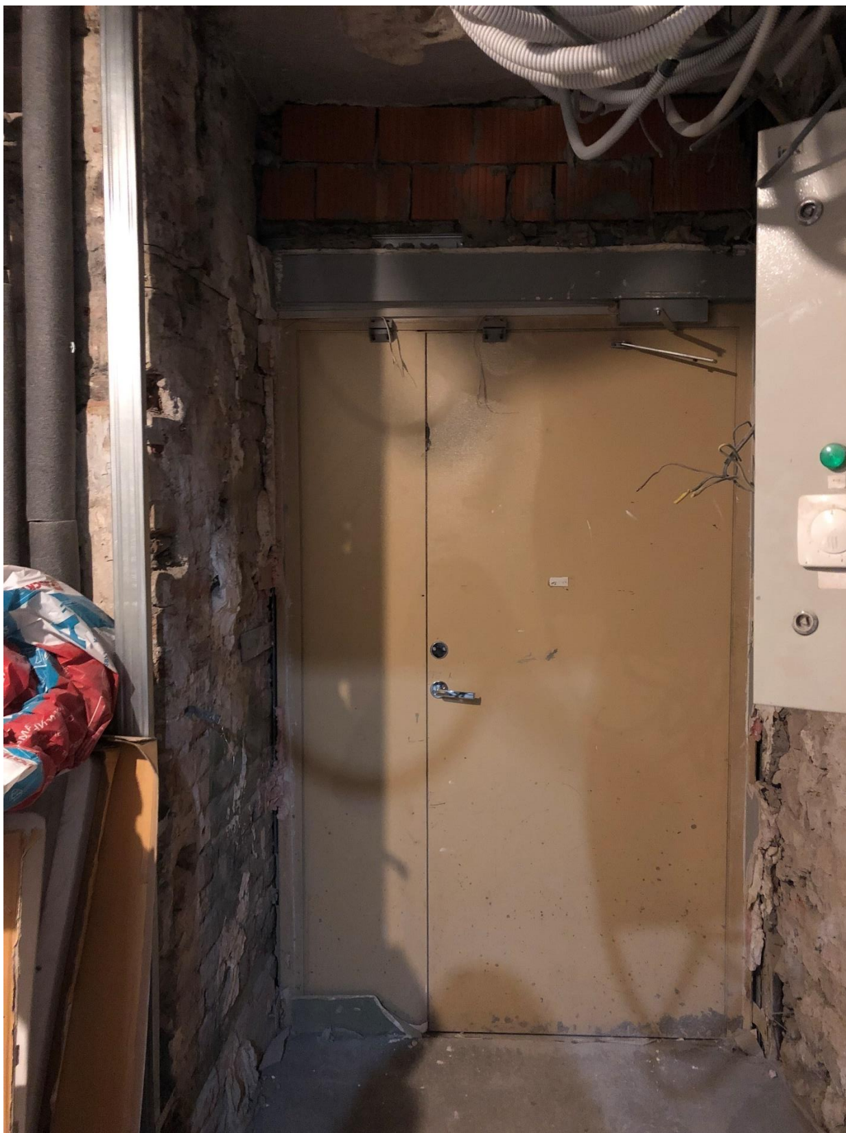
Фото 29. Вид на вторую входную дверь.
