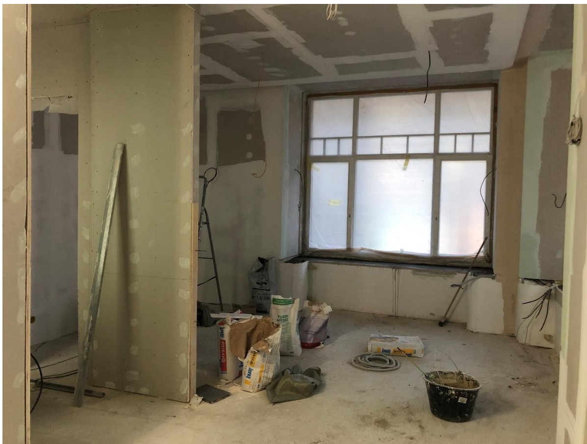
Фото 15. Вид на окно северо-западного помещения.
