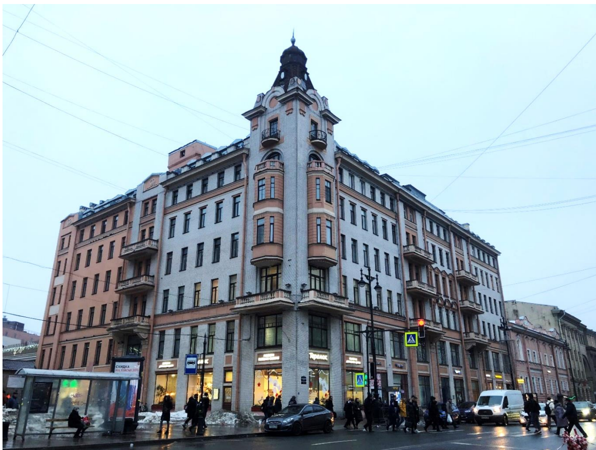
Фото 1. Вид на угол лицевых фасадов здания с Московского проспекта.
