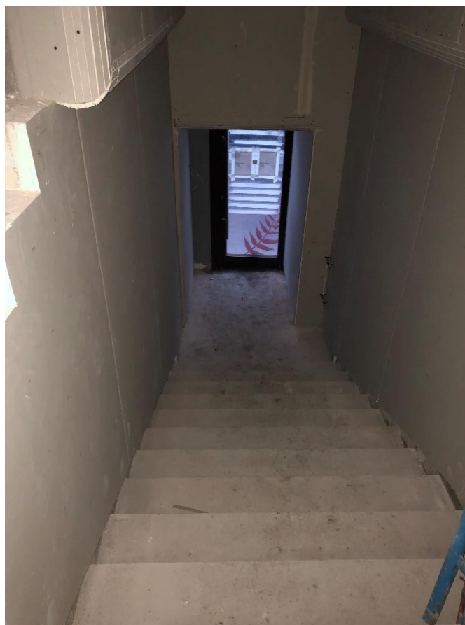
Фото 2. Вид на вход (со стороны Московского пр.) с межлестничной площадки.
