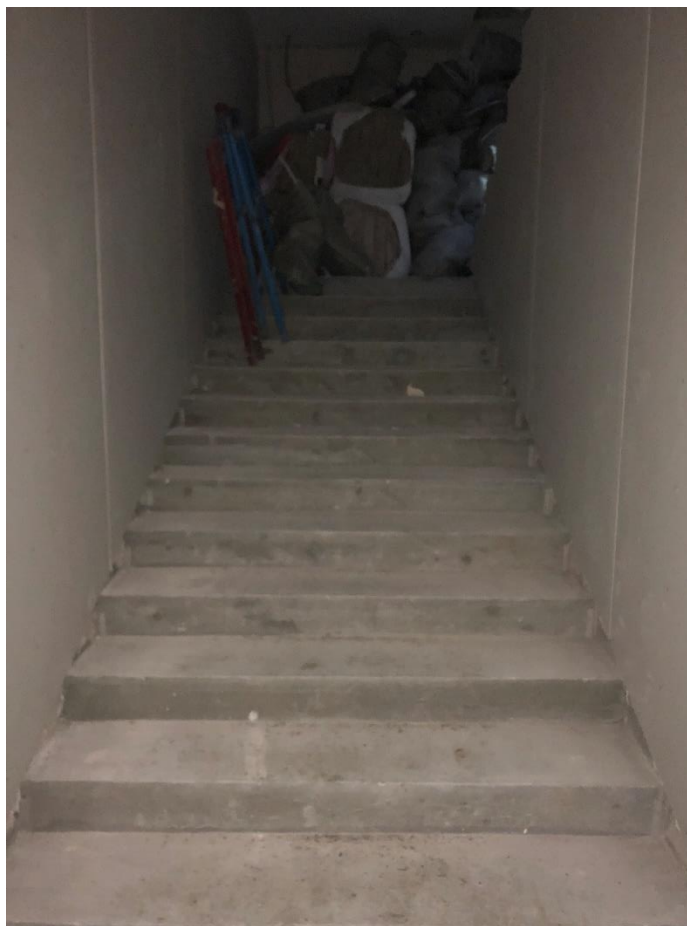
Фото 1. Вид на лестницу от входа (со стороны Московского пр.)
