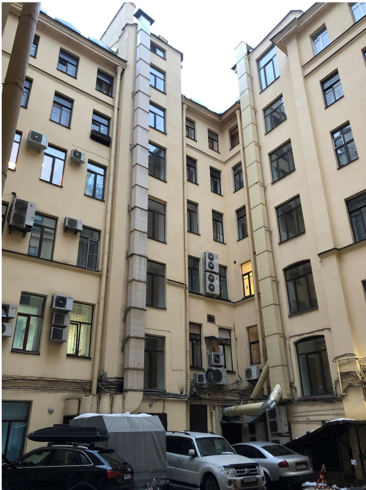
Фото 6. Вид на северо-западные дворовые фасады.
