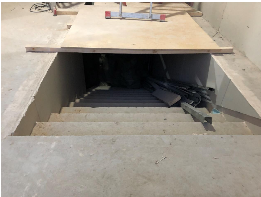
Фото 4. Вид из вестибюля на лестницу.
