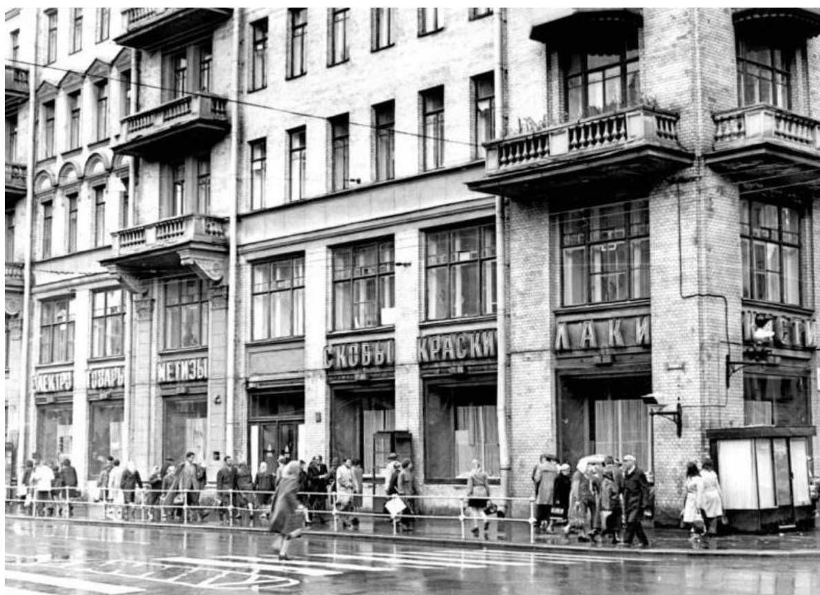
Илл. 17. Вид на западный (лицевой) фасад дома № 4 выявленного объекта культурного наследия регионального значения «Дома М.В. Вяземской (2 здания)». Дата: 1977 г. Источник: информационный портал pastvu.
