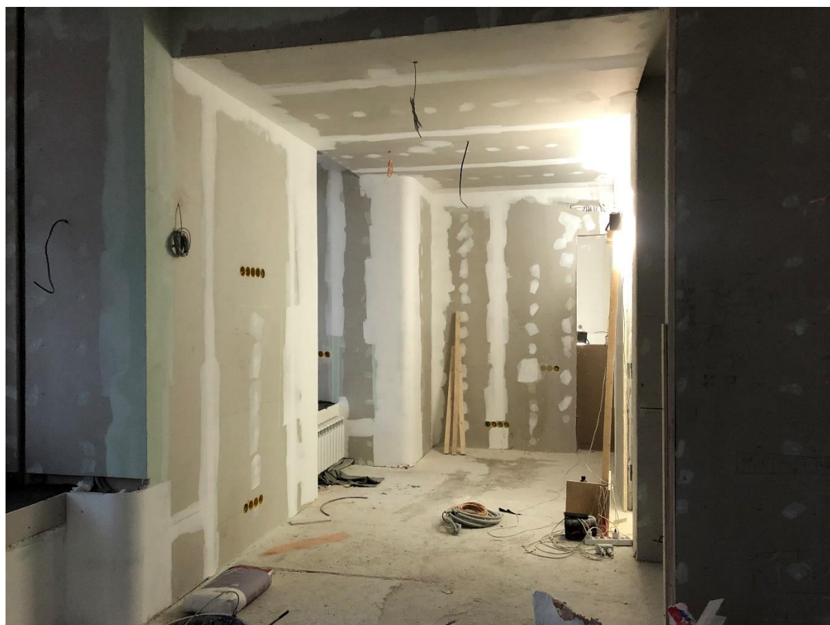
Фото 14. Вид на фрагмент северо-западного помещения.
