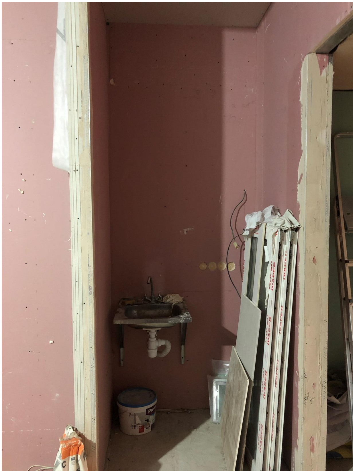
Фото 7. Вид на фрагмент вестибюля.
