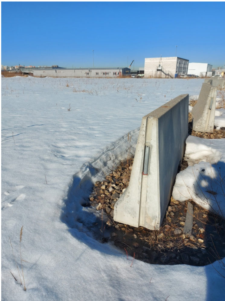
Точка фотофиксации 5. Восточная граница территории обследования с ЮВ.
