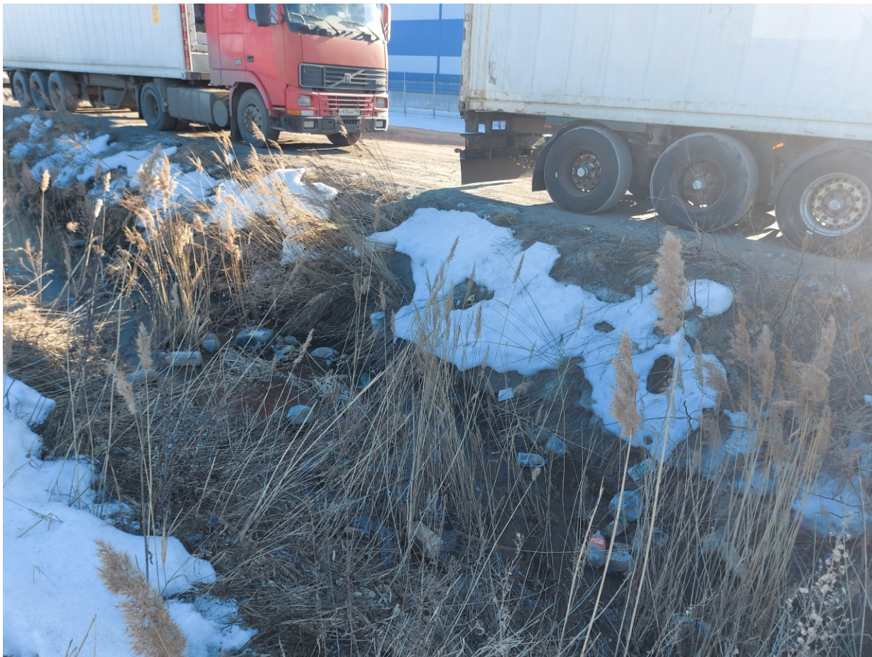
Точка фотофиксации 17. Южная граница территории обследования, дренажная канава по периметру участка, вид с 3.
