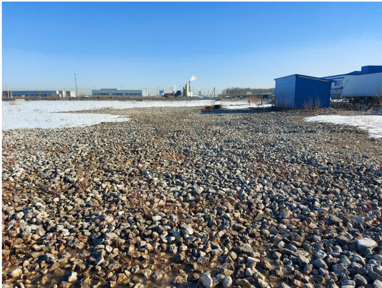
Точка фотофиксации 2. Общий вид южной части территории обследования с ЮЗ.
