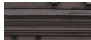
горизонтальные членения профилированными межэтажными карнизами, в т.ч. на стилизованных кронштейнах в ризалитах;
