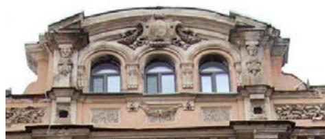
боковые ризалиты – раскрепованный аттик с кронштейнами и гирляндами; профилированный карниз;
