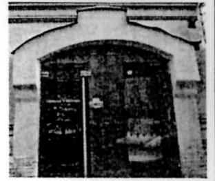
оформление оконных проемов: профилированные наличники, соединенные тягой – габариты, местоположение (1-й этаж);
