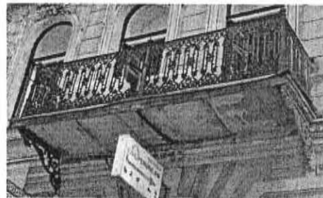
балконные ограждения – секции чугунного литья с растительным орнаментом с чугунными круглыми в сечении орнаментированными столбиками с навершием в виде шишки;
