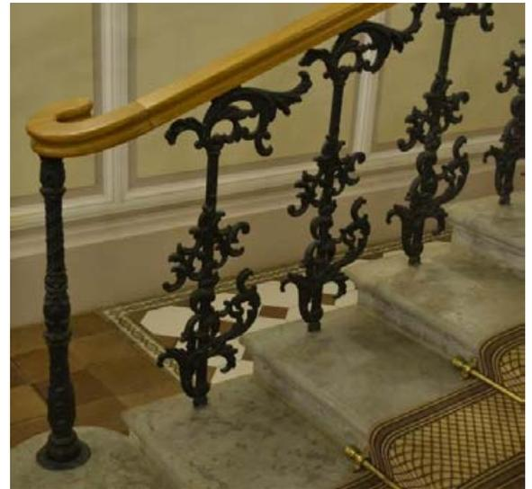
парадная лестница лестничного объема в форме полуротонды (лестница театра – 1ЛК) – двухмаршевая, с известняковыми ступенями и площадками с металлическим ограждением из секций с геометрическим орнаментом и деревянными поручнями.
