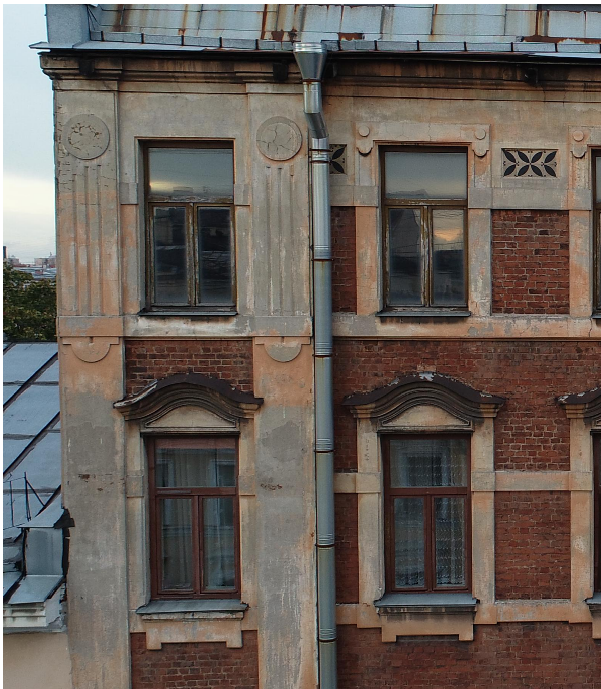
14. Объект культурного наследия регионального значения «Дом А.Н. Бебутовой», расположенный по адресу: г. Санкт-Петербург, наб. Крюкова канала, д. 27, литера А, пер. Макаренко, д. 10, литера А. Западный лицевой фасад (пер. Макаренко, д. 10, литера А). Фрагмент. Элементы декора –глазурованная плитка с монохромным рисунком в уровне 5-го этажа, в оконных простенках; оформление штукатурных лопаток; наличники и сандрики оконных проемов в уровне 4-го эт, наличники оконных проемов в уровне 5-го эт.
