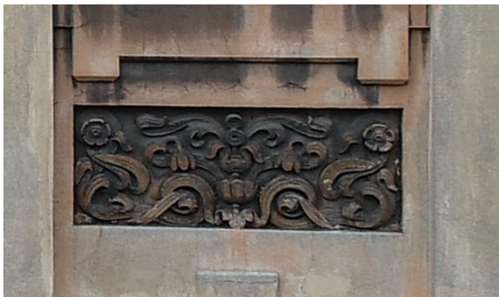
10. Объект культурного наследия регионального значения «Дом А.Н. Бебутовой», расположенный по адресу: г. Санкт-Петербург, наб. Крюкова канала, д. 27, литера А, пер. Макаренко, д. 10, литера А. Западный лицевой фасад (пер. Макаренко, д. 10, литера А). Фрагмент. Элемент декора –лепной декор в оформлении эркера в подоконном пространстве 4-го эт.
