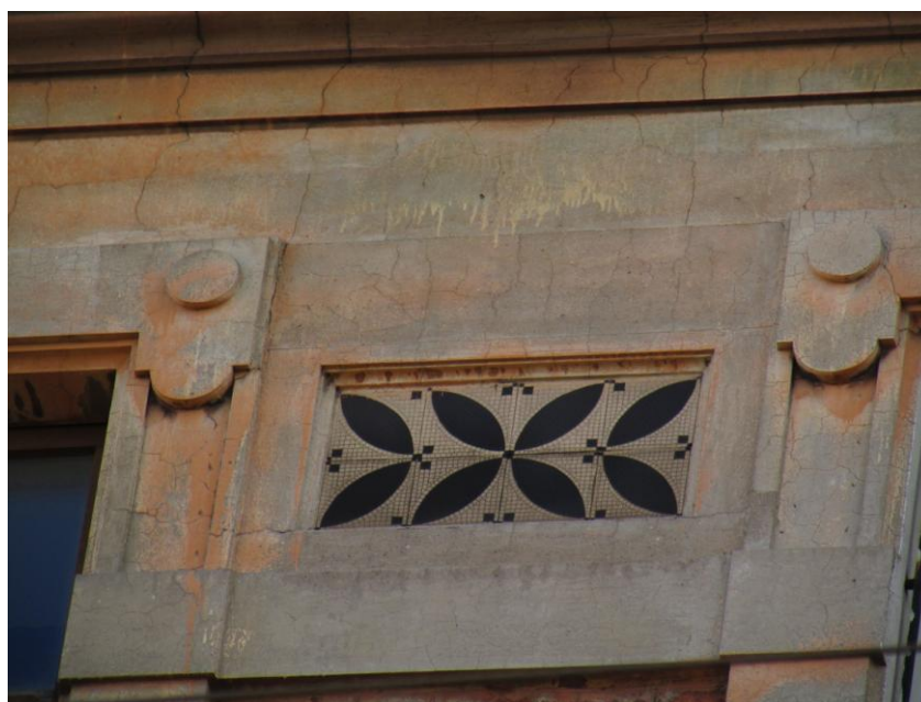
13. Объект культурного наследия регионального значения «Дом А.Н. Бебутовой», расположенный по адресу: г. Санкт-Петербург, наб. Крюкова канала, д. 27, литера А, пер. Макаренко, д. 10, литера А. Западный лицевой фасад (пер. Макаренко, д. 10, литера А). Фрагмент. Элемент декора –глазурованная плитка с монохромным рисунком в уровне 5-го этажа, в оконных простенках.
