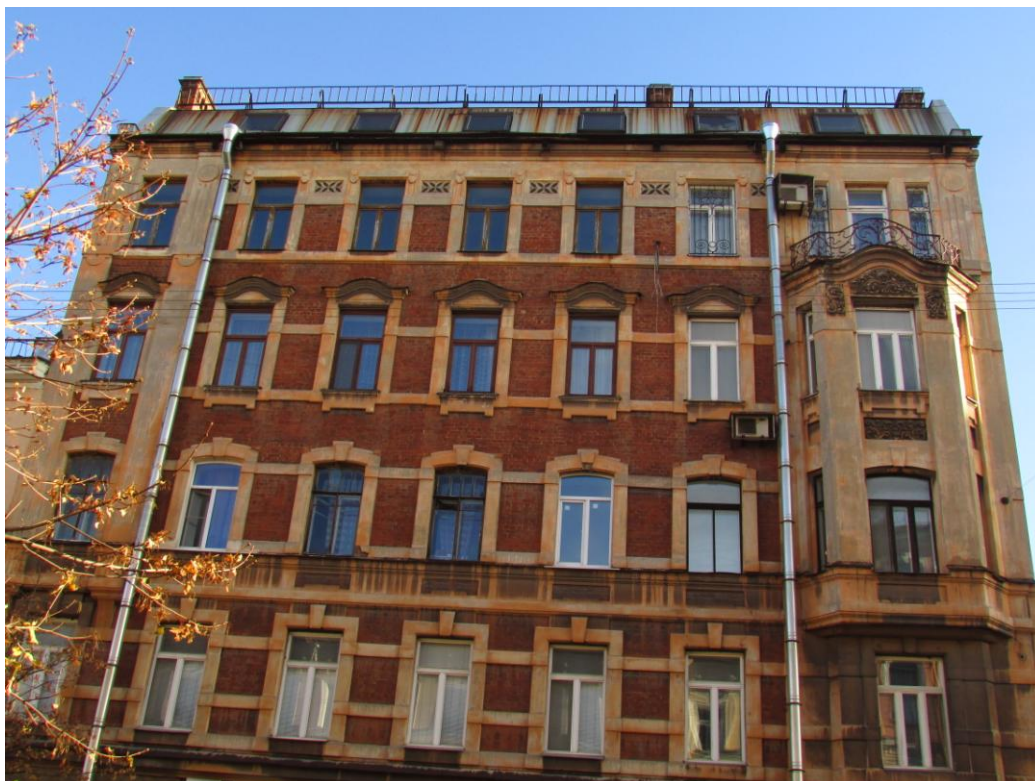
3. Объект культурного наследия регионального значения «Дом А.Н. Бебутовой», расположенный по адресу: г. Санкт-Петербург, наб. Крюкова канала, д. 27, литера А, пер. Макаренко, д. 10, литера А. Лицевой западный корпус (пер. Макаренко, д. 10, литера А). Лицевой фасад. Фрагмент.
