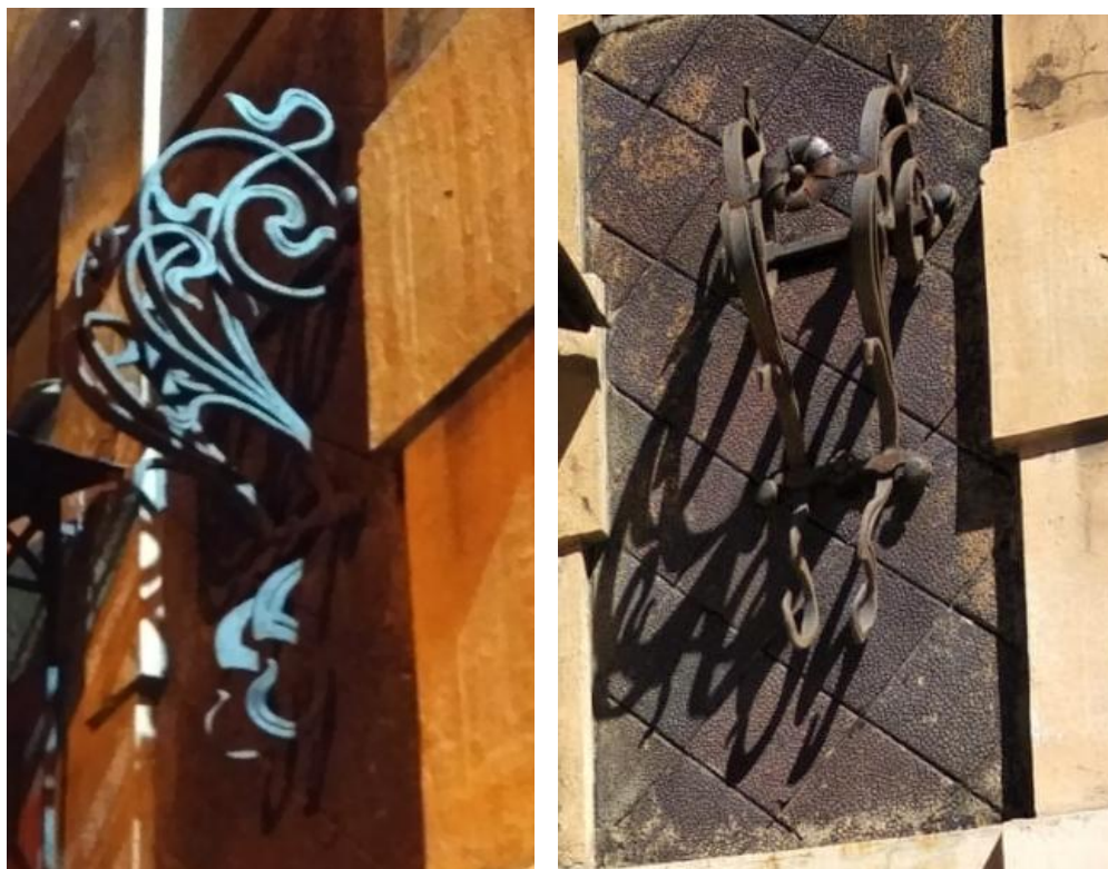
11, 12. Объект культурного наследия регионального значения «Дом А.Н. Бебутовой», расположенный по адресу: г. Санкт-Петербург, наб. Крюкова канала, д. 27, литера А, пер. Макаренко, д. 10, литера А. Западный лицевой фасад (пер. Макаренко, д. 10, литера А). Фрагмент. Элемент декора –кованный флажток. С правой стороны от входа в уровне 1-го этажа; метлахская поитка в облицовке 1-го эт.
