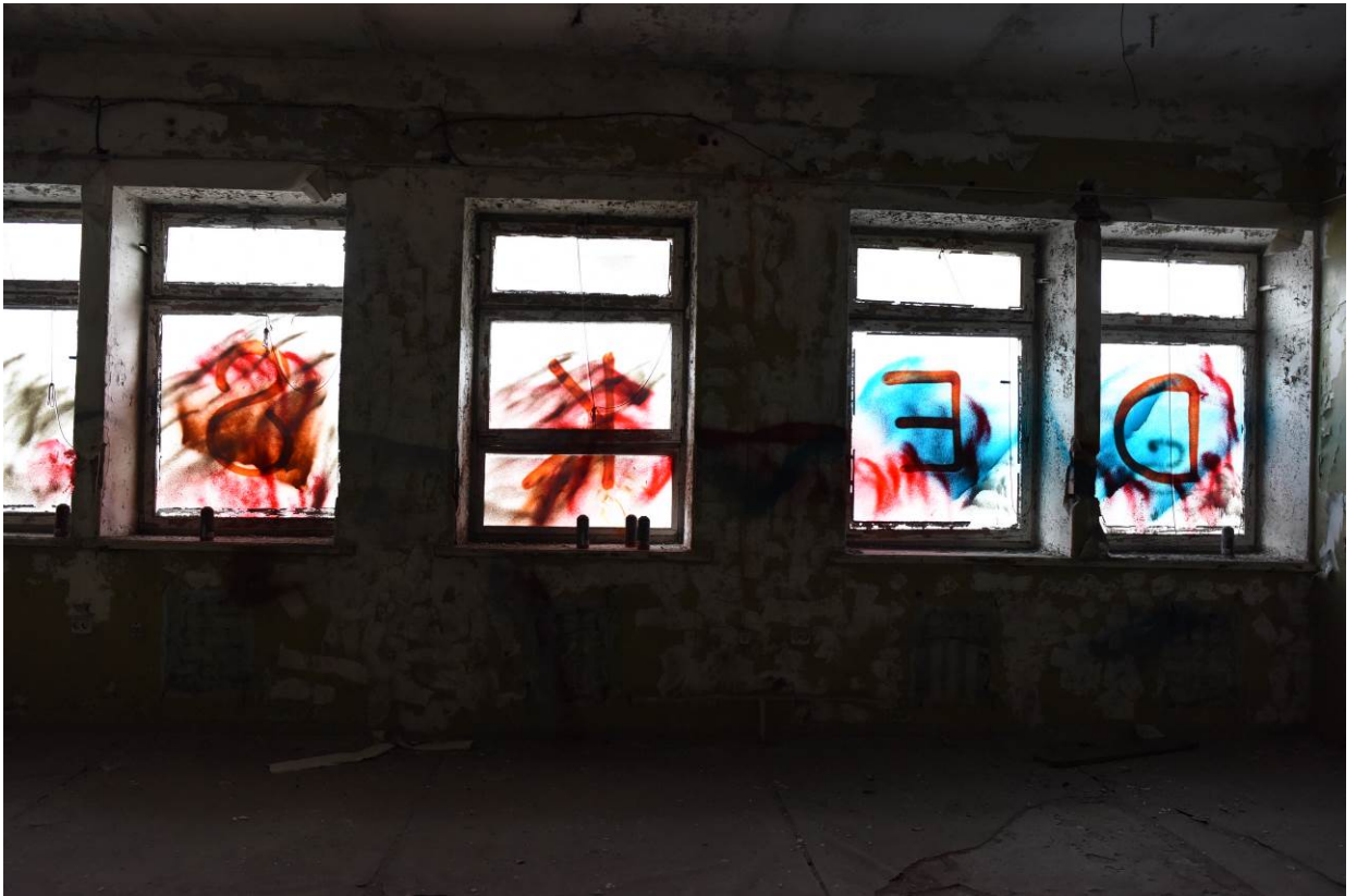
26. Выявленный объект культурного наследия «Здание, в котором размещались издательство и типография Ф.А. Брокгауза и И.А. Ефрон». Помещение четвертого этажа.
