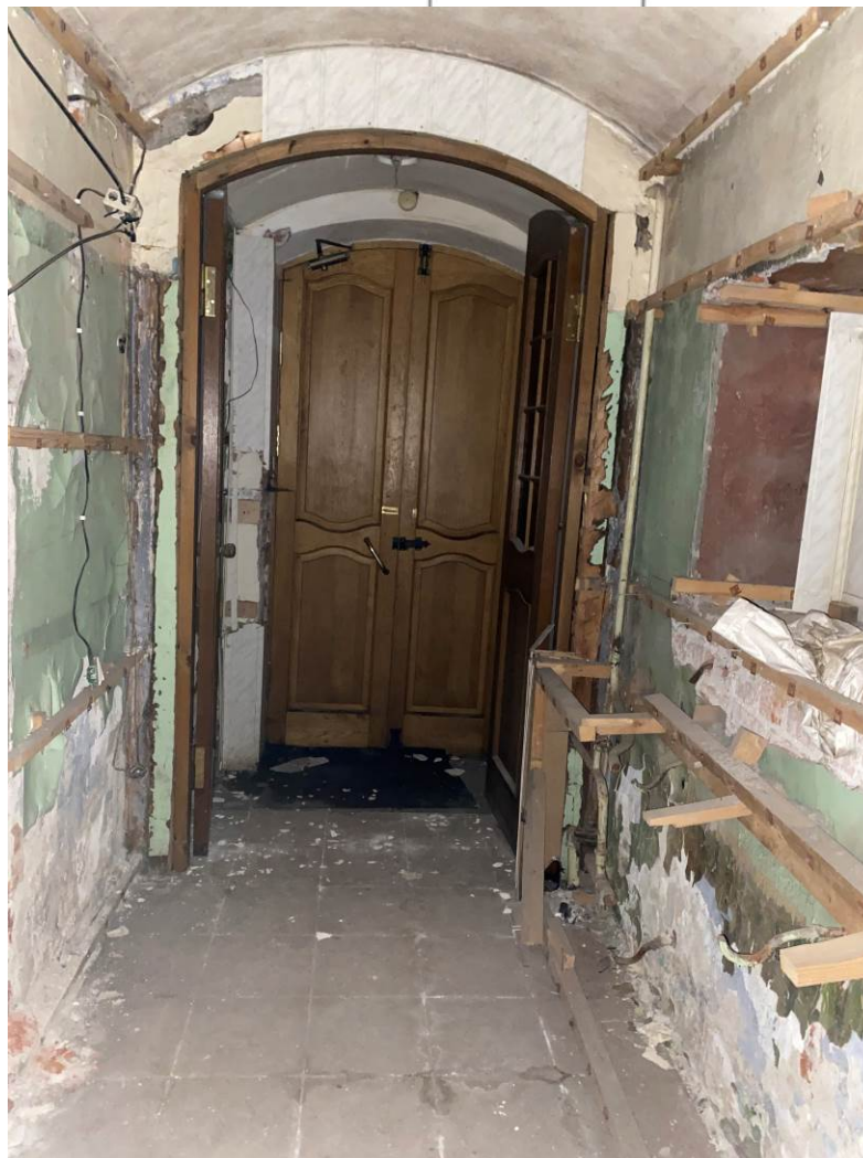
34. Выявленный объект культурного наследия «Здание, в котором размещались издательство и типография Ф.А. Брокгауза и И.А. Ефрон». Помещение первого этажа.
