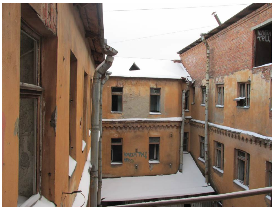
24. Выявленный объект культурного наследия «Здание, в котором размещались издательство и типография Ф.А. Брокгауза и И.А. Ефрон». Вид во двор с лестницы.
