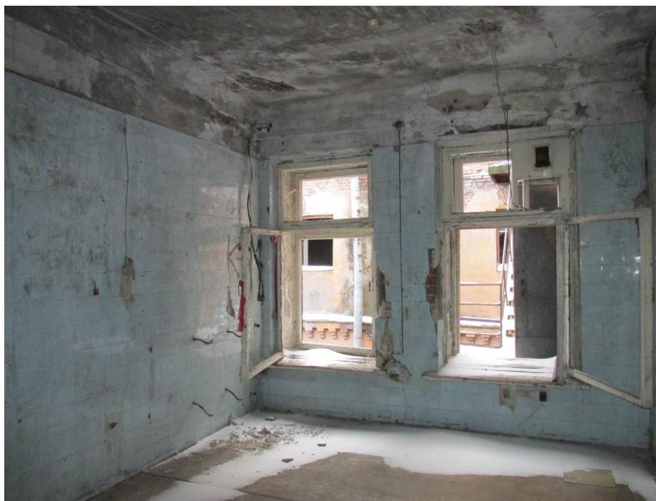
27. Выявленный объект культурного наследия «Здание, в котором размещались издательство и типография Ф.А. Брокгауза и И.А. Ефрон». Помещение четвертого этажа.
