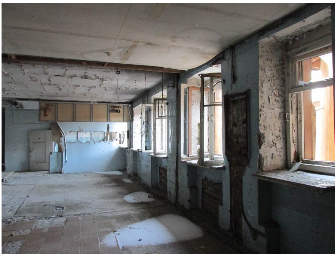
21. Выявленный объект культурного наследия «Здание, в котором размещались издательство и типография Ф.А. Брокгауза и И.А. Ефрон». Помещение четвертого этажа.
