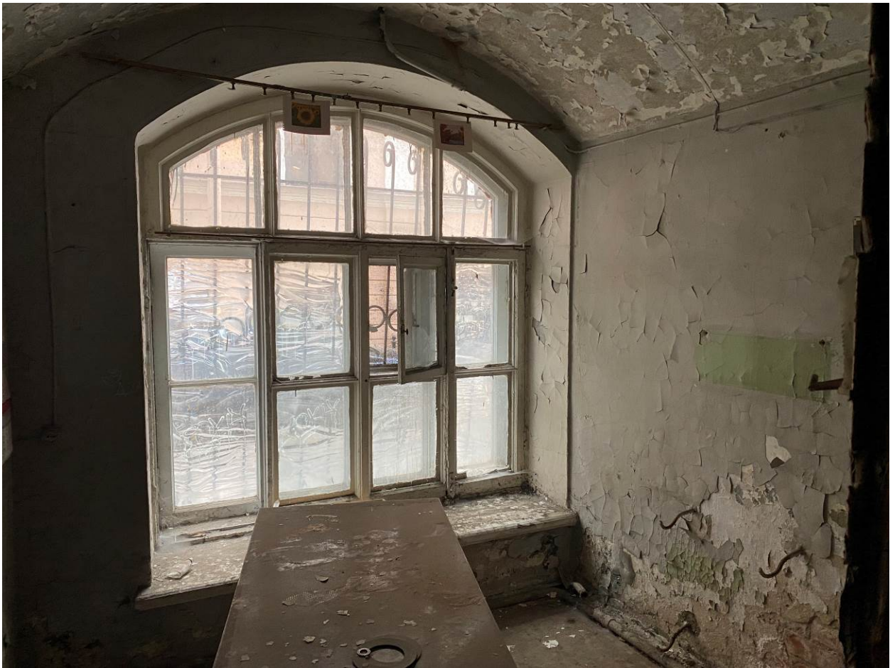
32. Выявленный объект культурного наследия «Здание, в котором размещались издательство и типография Ф.А. Брокгауза и И.А. Ефрон». Помещение первого этажа.
