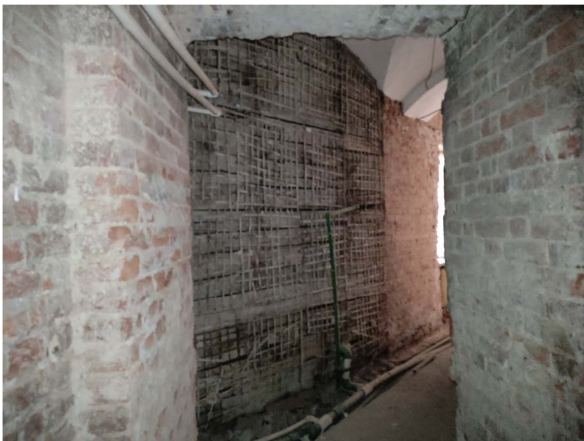
Фото 25. Интерьер квартиры №13, ч.п.№1(дата фотофиксации: 08.10.2021)
