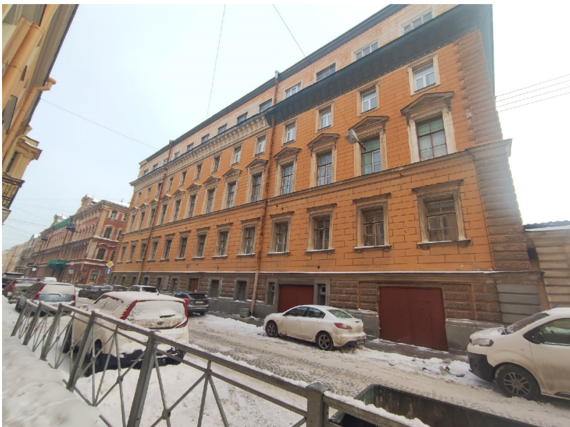
Фото 5. Фрагмент лицевого фасада объекта культурного наследия федерального значения «Корпус для прислуги», входящего в состав объекта культурного наследия федерального значения «Дворец Великого князя Николая Николаевича (Ксенинский институт)», вид со стороны улицы Галерной (дата фотофиксации: 10.12.2021)
