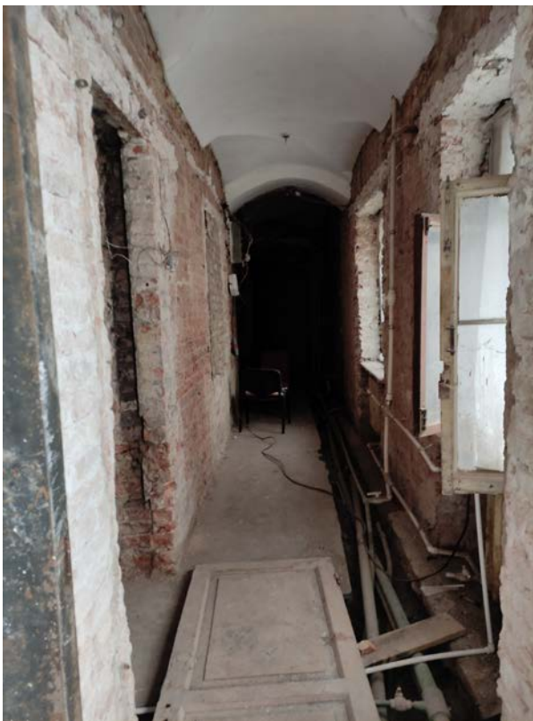
Фото 11. Интерьер коридора ч.п.№ 1(дата фотофиксации: 08.10.2021)
