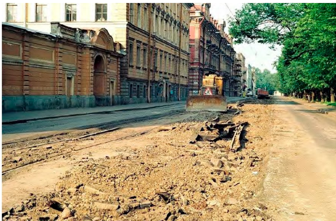
47. Демонтаж трамвайной линии на Конногвардейском бульваре. 1987 г. — «PastVu» – ретро-фотографии стран и городов [Электронный ресурс]. URL: https://pastvu.com/p/129637 .
