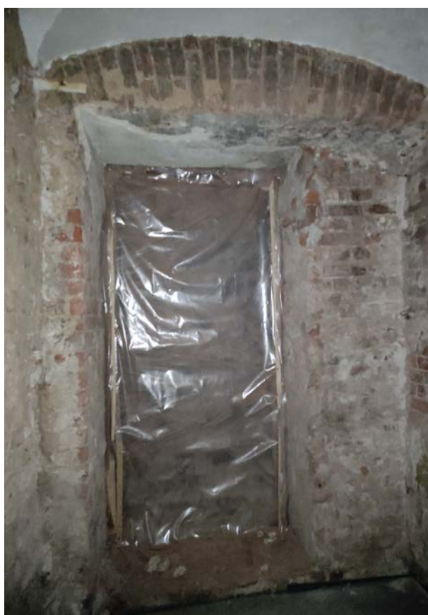
Фото 21. Интерьер квартиры 13, ч.п.№4(дата фотофиксации: 08.10.2021)
