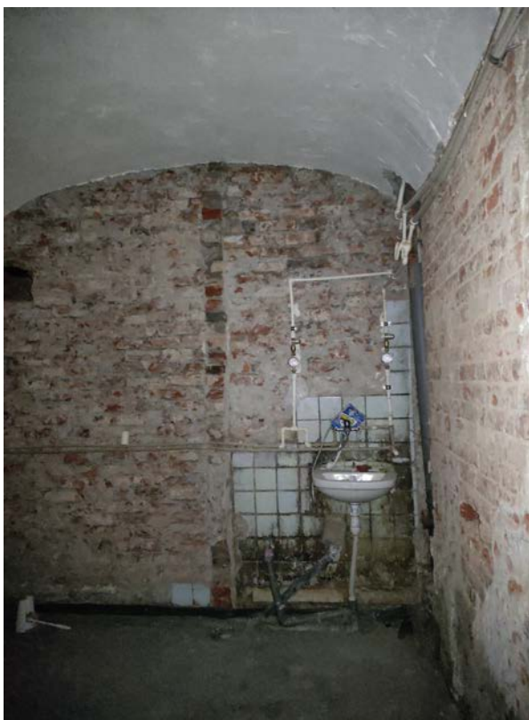
Фото 23. Интерьер квартиры №13, ч.п.№1(дата фотофиксации: 08.10.2021)
