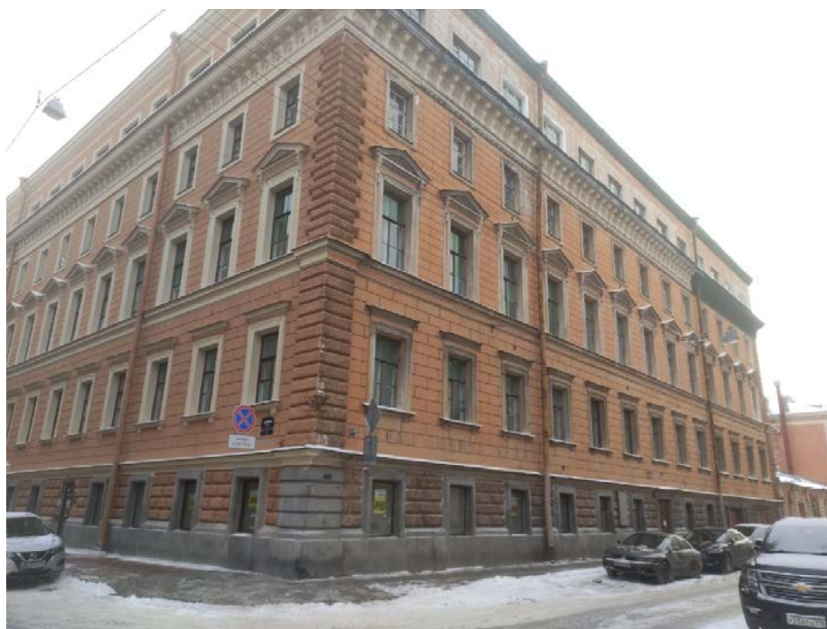
Фото 4. Фрагмент лицевого фасада объекта культурного наследия федерального значения «Корпус для прислуги», входящего в состав объекта культурного наследия федерального значения «Дворец Великого князя Николая Николаевича (Ксенинский институт)», вид со стороны улицы Галерной (дата фотофиксации: 10.12.2021)
