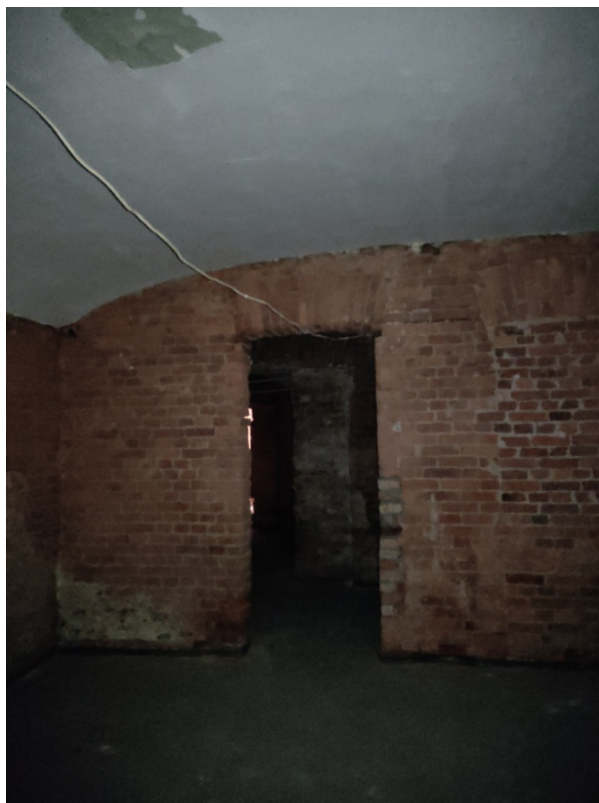
Фото 20. Интерьер квартиры №13, ч.п.№12(дата фотофиксации: 08.10.2021)
