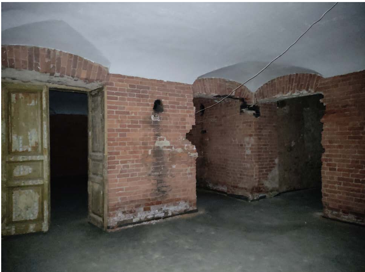
Фото 17. Интерьер квартиры 12,13, ч.п.№ 4,7,5,6 (дата фотофиксации: 08.10.2021)
