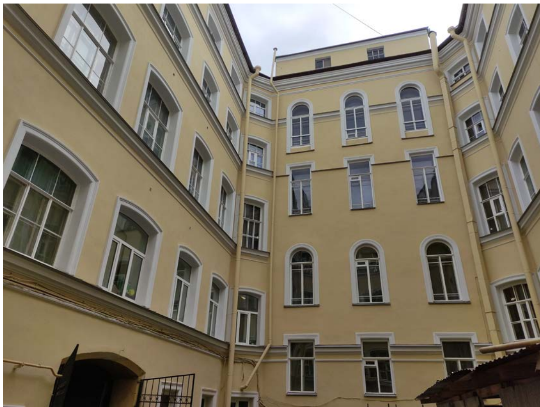
Фото 7. Фрагмент дворового фасада объекта культурного наследия федерального значения «Корпус для прислуги», входящего в состав объекта культурного наследия федерального значения «Дворец Великого князя Николая Николаевича (Ксенинский институт)» (дата фотофиксации: 08.10.2021)
