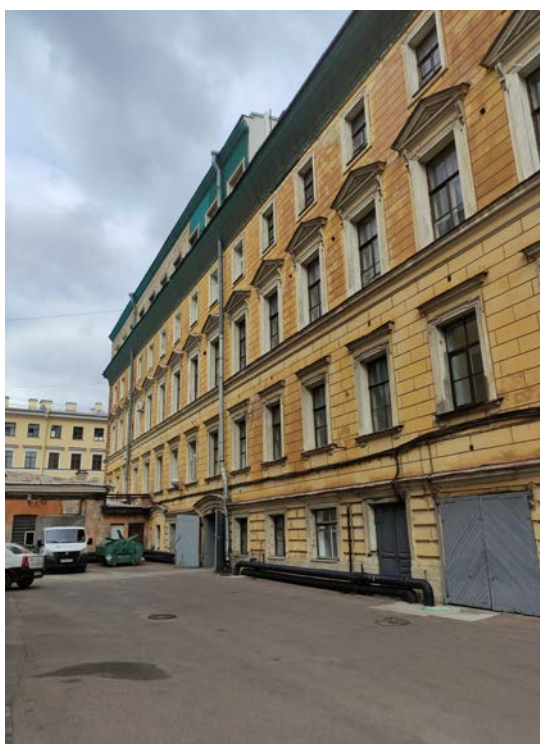
Фото 6. Фрагмент дворового фасада объекта культурного наследия федерального значения «Корпус для прислуги», входящего в состав объекта культурного наследия федерального значения «Дворец Великого князя Николая Николаевича (Ксенинский институт)» (дата фотофиксации: 08.10.2021)
