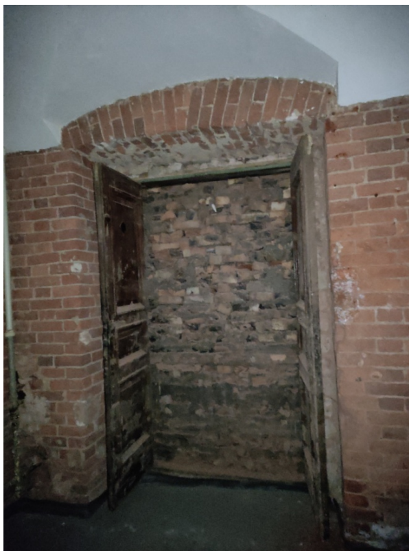
Фото 19. Интерьер квартиры №13, ч.п.№12(дата фотофиксации: 08.10.2021)
