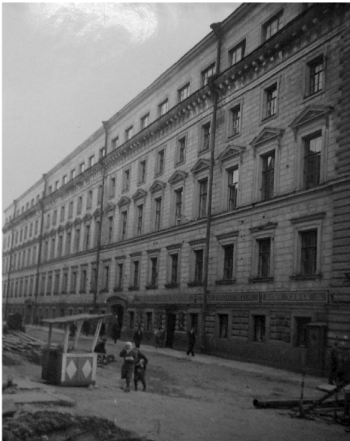
43. Фасад корпуса для прислуги со стороны Замятина переулка. 1951 г. — Архив КГИОП.
