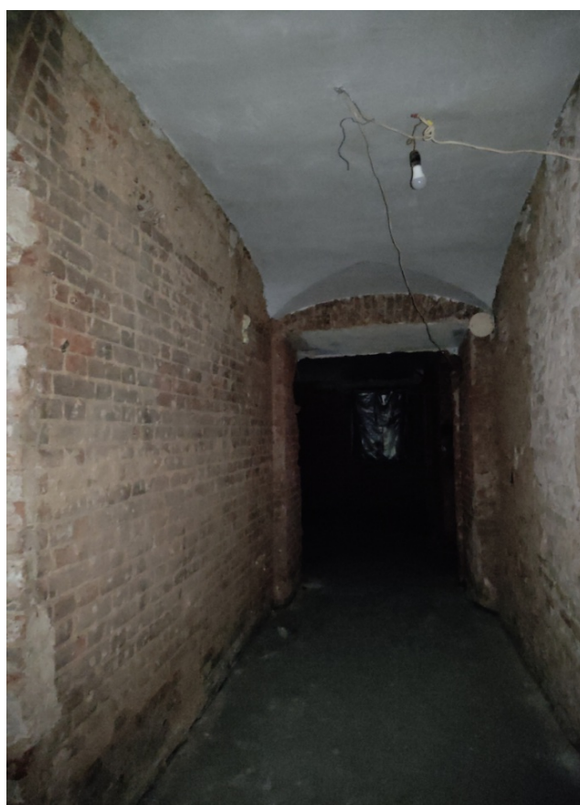
Фото 22. Интерьер квартиры 13, ч.п.№4(дата фотофиксации: 08.10.2021)
