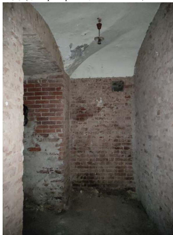
Фото 16. Интерьер квартиры 13, ч.п.№5(дата фотофиксации: 08.10.2021)
