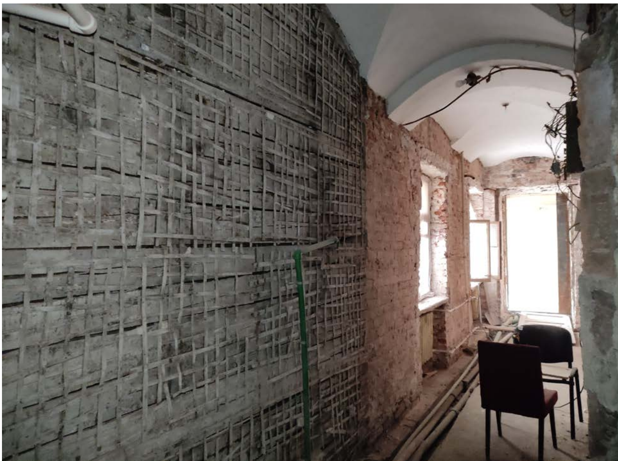
Фото 26. Интерьер коридора, ч.п.№1(дата фотофиксации: 08.10.2021)
