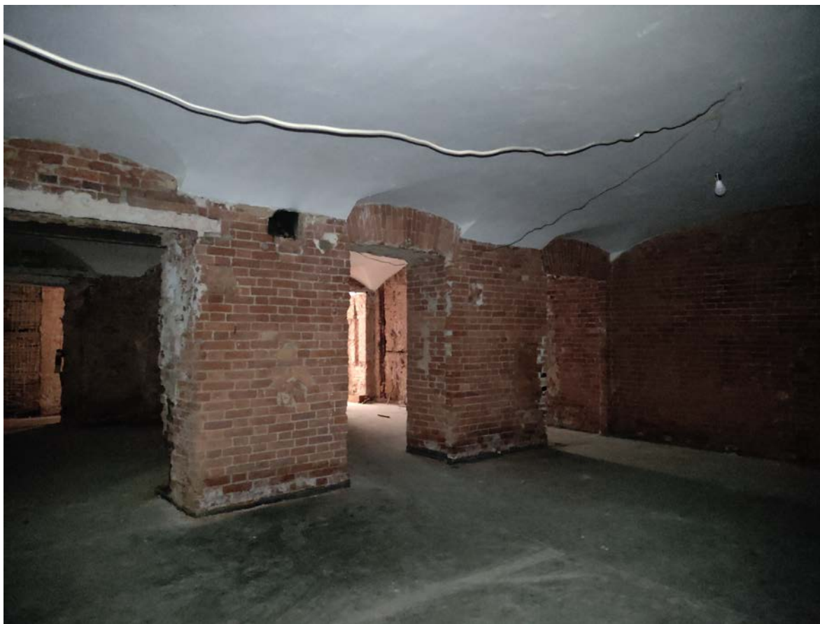
Фото 14. Интерьер квартиры №11,12, ч.п.№3,4,3(дата фотофиксации: 08.10.2021)
