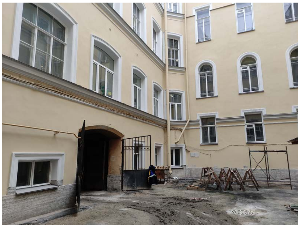
Фото 8. Фрагмент дворового фасада объекта культурного наследия федерального значения «Корпус для прислуги», входящего в состав объекта культурного наследия федерального значения «Дворец Великого князя Николая Николаевича (Ксенинский институт)» (дата фотофиксации: 08.10.2021)
