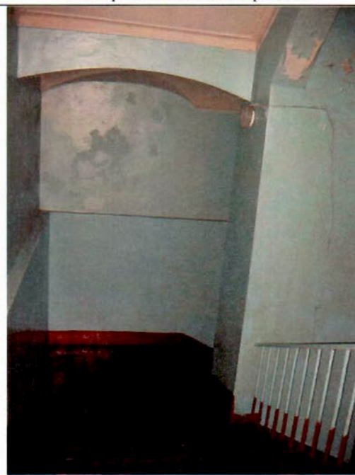
39. Лестница в южном крыле. Фрагмент.
