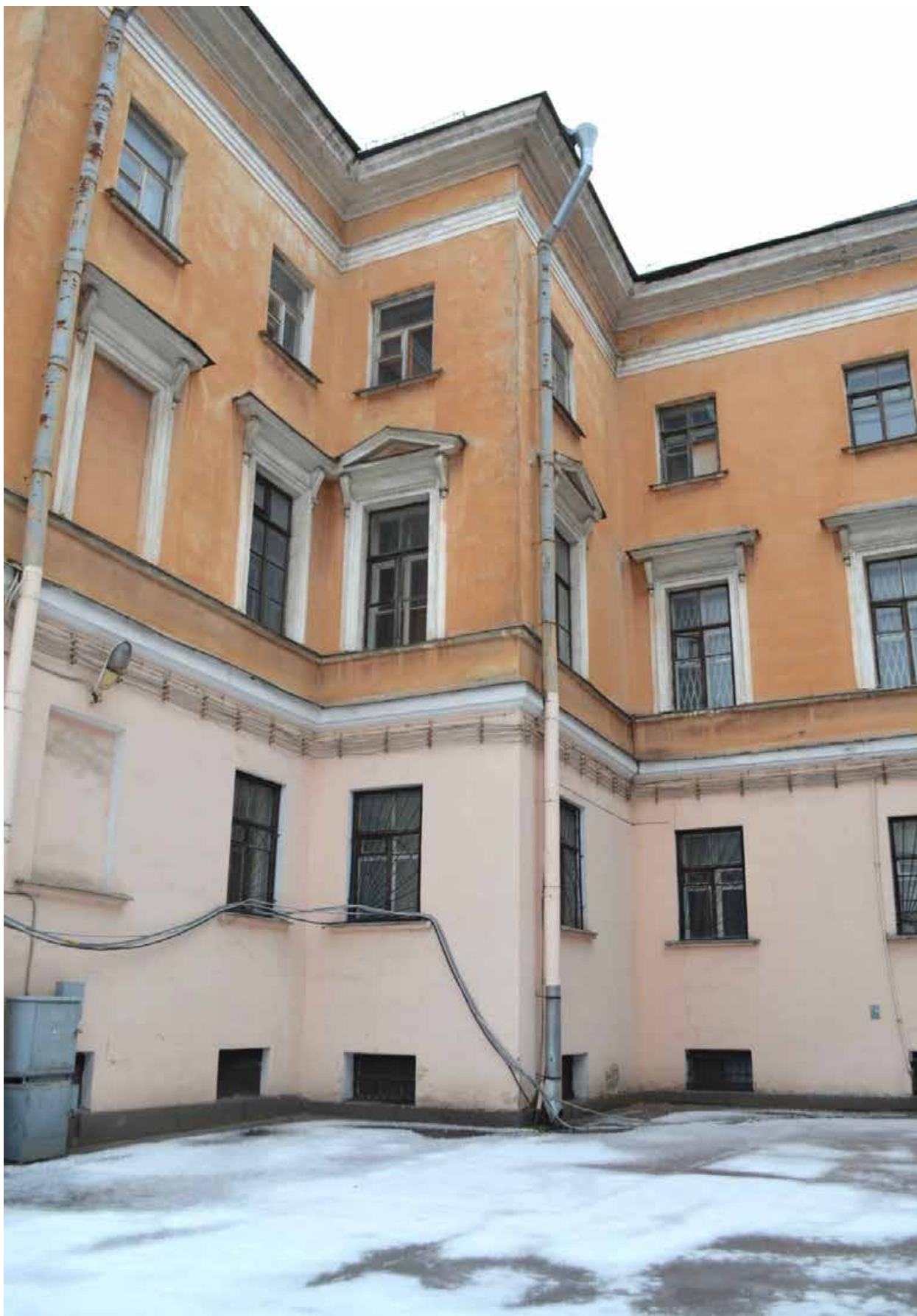
Фото 1.20. Духовная академия. Главное здание (наб. Обводного канала, 7, литер Г). Западный дворовый фасад. Фрагмент. Съёмка 01.12.2021 г.
