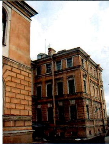
11. Западный фасад. Фрагмент.
