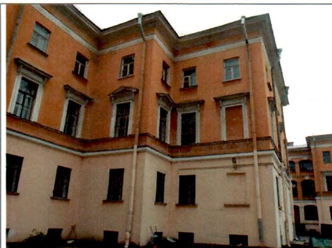
12. Дворовые фасады северного флигеля.
