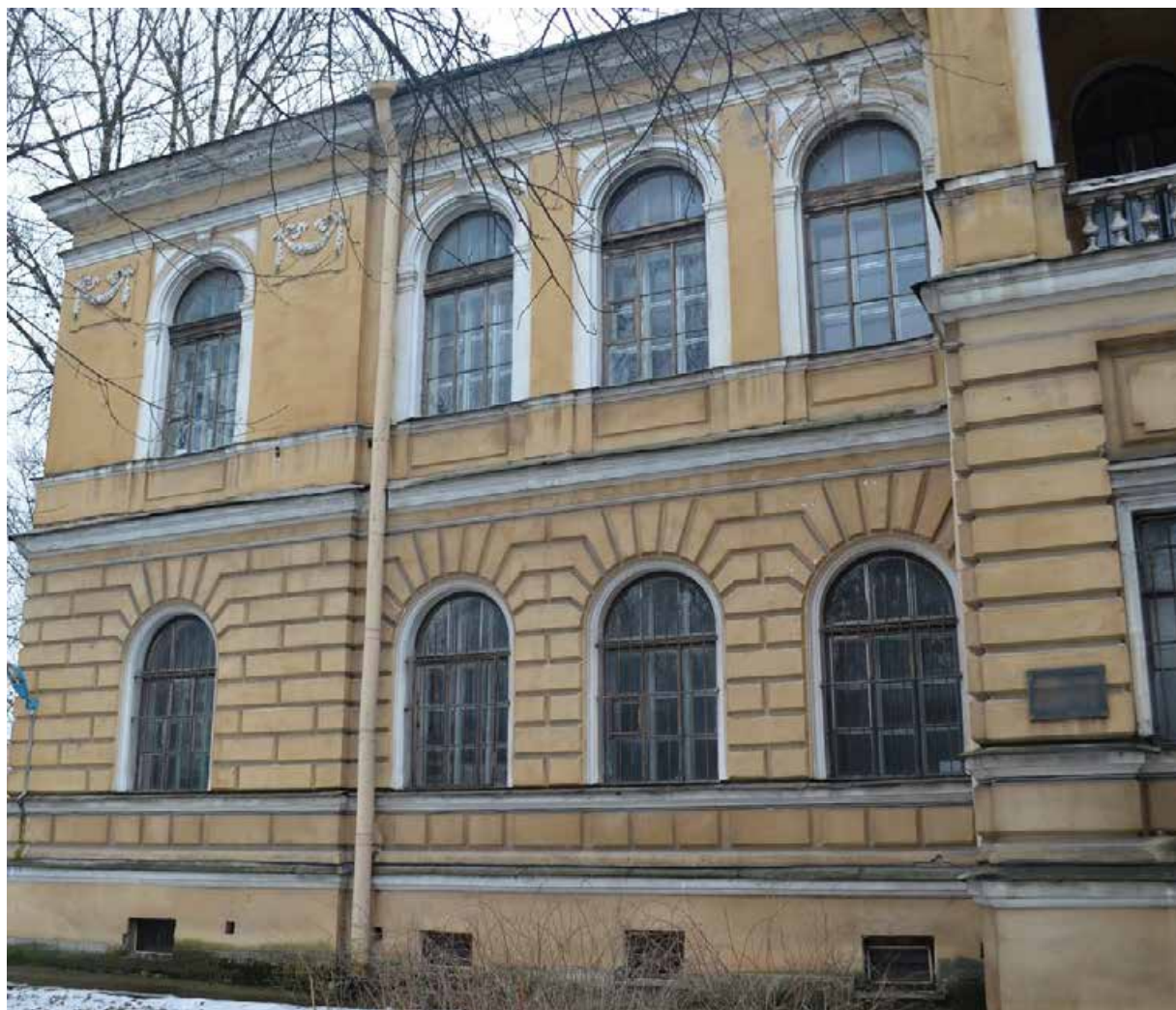
Фото 3.13. Духовная академия. Библиотека (наб. Обводного канала, 11, литер А). Северный фасад. Фрагмент. Съёмка 01.12.2021 г.
