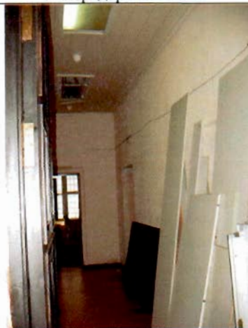
11. Коридор 1-го этажа. Общий вид.
