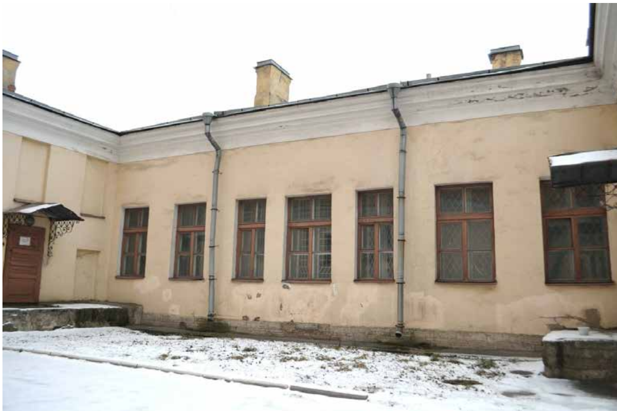
Фото 2.6. Духовная академия. Больничный флигель (наб. Обводного канала, 7, литер А). Восточный фасад. Фрагмент. Съёмка 01.12.2021 г.
