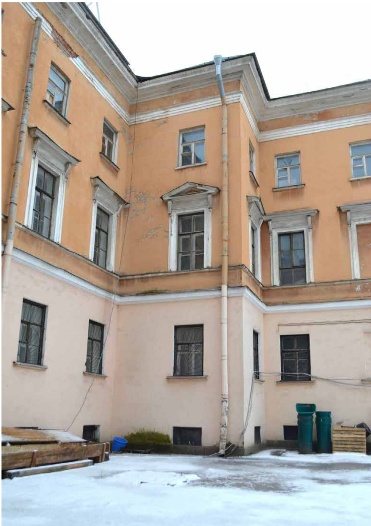
Фото 1.17. Духовная академия. Главное здание (наб. Обводного канала, 7, литер Г). Западный дворовый фасад. Фрагмент. Съёмка 01.12.2021 г.
