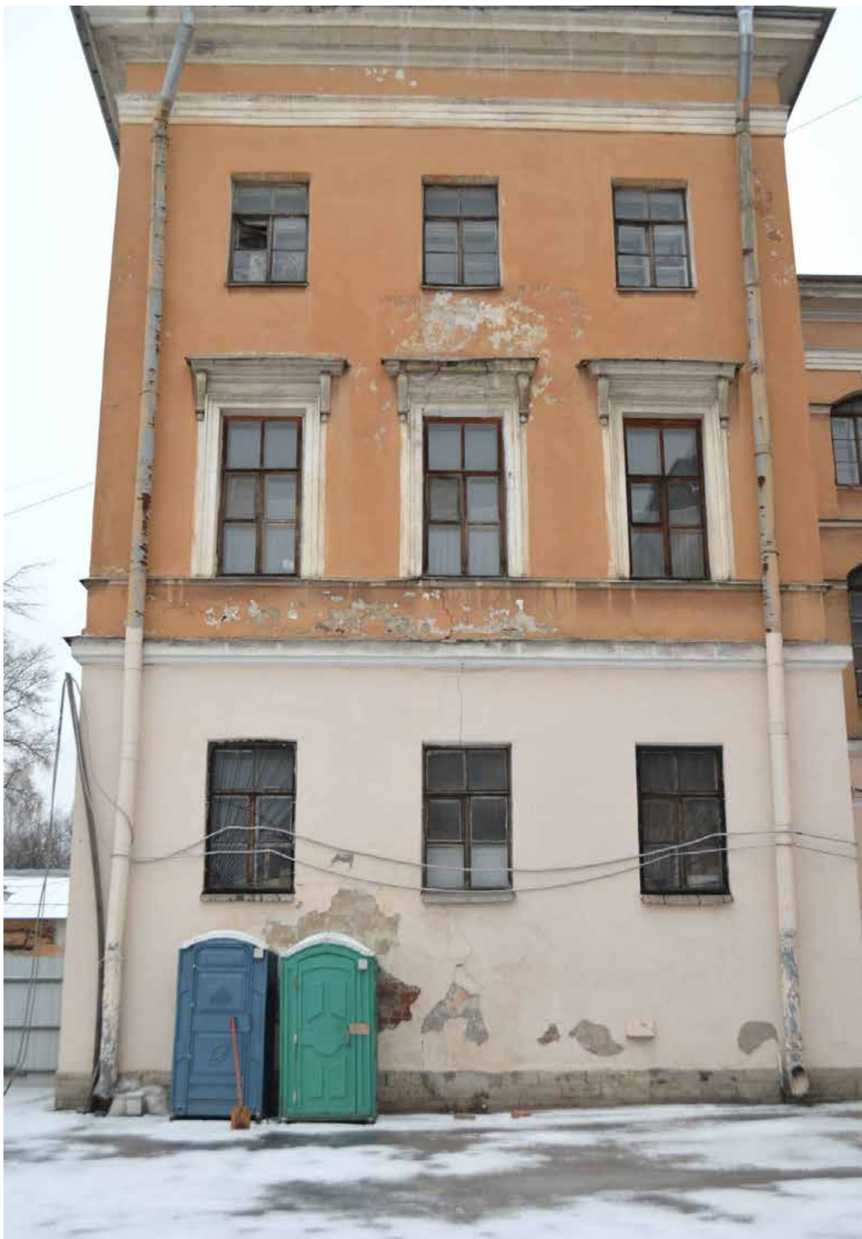
Фото 1.14. Духовная академия. Главное здание (наб. Обводного канала, 7, литер Г). Западный дворовый фасад. Фрагмент. Съёмка 01.12.2021 г.
