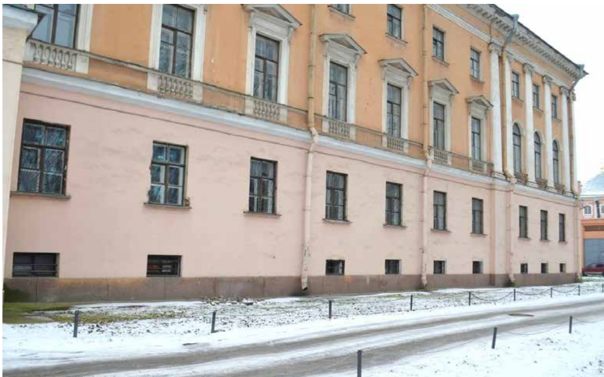
Фото 1.7. Духовная академия. Главное здание (наб. Обводного канала, 7, литер Г). Восточный фасад. Фрагмент. Съёмка 01.12.2021 г.
