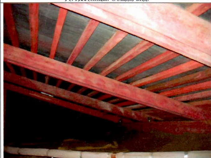
13. Конструкции крыши. Общий вид.
