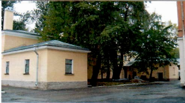
3. Восточный фасад. Общий вид.
