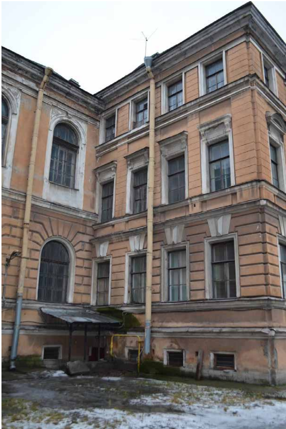
Фото 3.6. Духовная академия. Библиотека (наб. Обводного канала, 11, литер А). Западный фасад. Фрагмент. Съёмка 01.12.2021 г.
