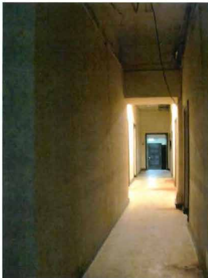
5. Первый этаж. Коридор (пом. 1-Н (13)).
