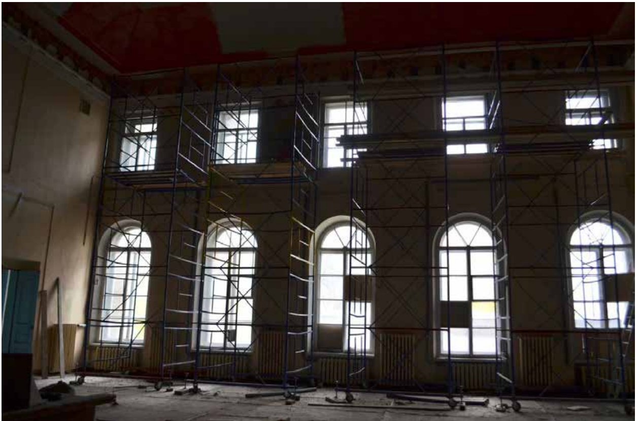
Фото 1.32. Духовная академия. Главное здание (наб. Обводного канала, 7, литер Г). Помещение второго этажа. Фрагмент. Съёмка 01.12.2021 г.
