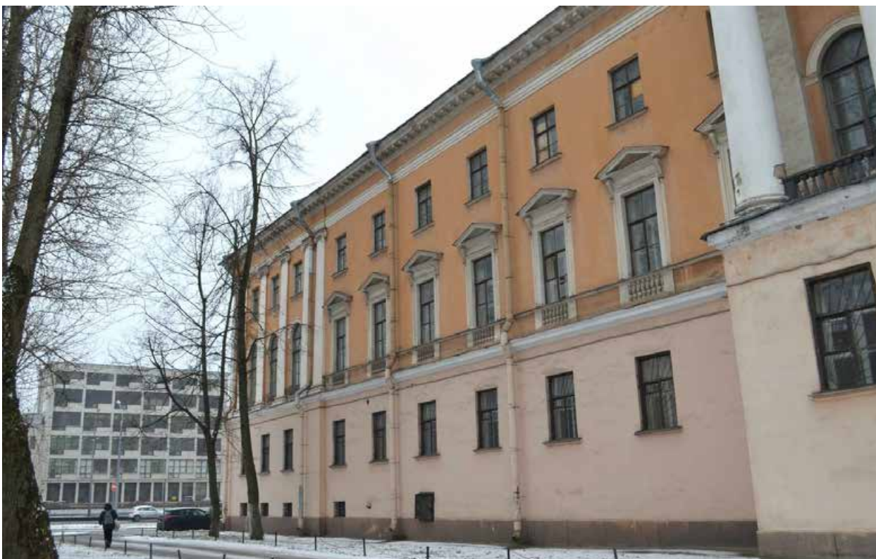
Фото 1.3. Духовная академия. Главное здание (наб. Обводного канала, 7, литер Г). Восточный фасад. Фрагмент. Съёмка 01.12.2021 г.
