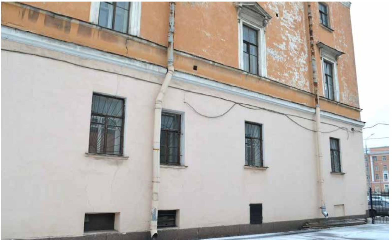
Фото 1.26. Духовная академия. Главное здание (наб. Обводного канала, 7, литер Г). Западный дворовый фасад. Фрагмент. Съёмка 01.12.2021 г.
