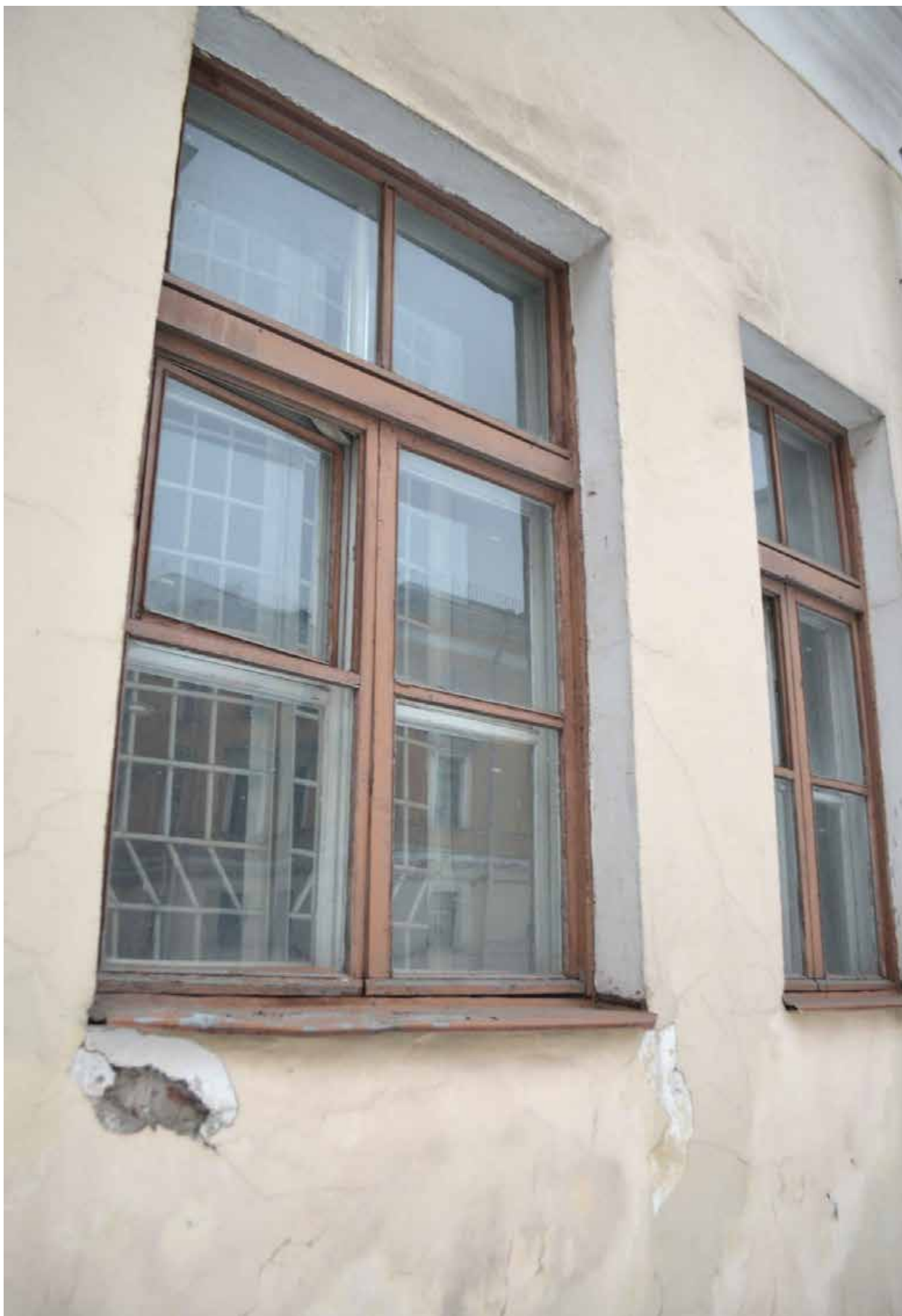
Фото 2.8. Духовная академия. Больничный флигель (наб. Обводного канала, 7, литер А). Восточный фасад. Оконный проём. Фрагмент. Съёмка 01.12.2021 г.
