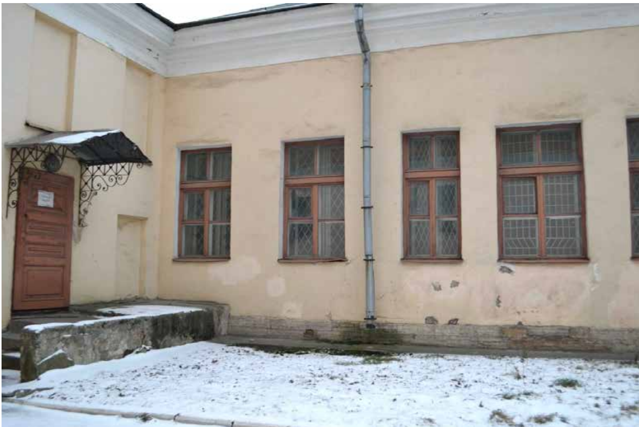
Фото 2.7. Духовная академия. Больничный флигель (наб. Обводного канала, 7, литер А). Восточный фасад. Фрагмент. Съёмка 01.12.2021 г.
