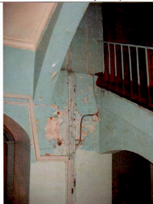
41. Лестница в южном крыле. Фрагмент.
