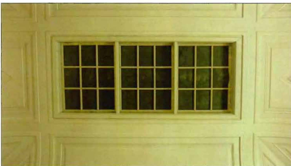
9. Световой фонарь над парадной лестницей (пом. 1-Н (48)).
