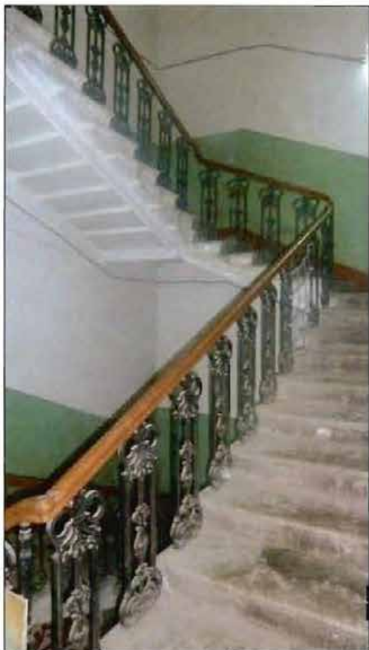
7. Лестница в южной части здания. Л-1.
