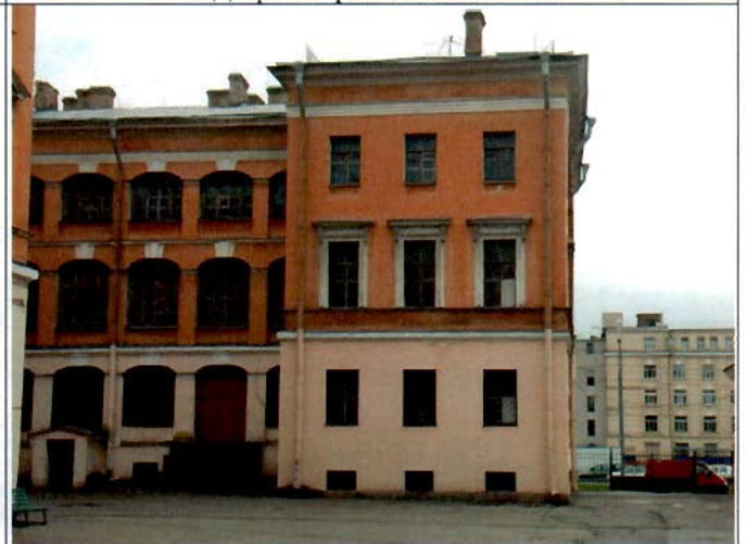
11. Дворовые фасады южного флигеля. Общий вид.
