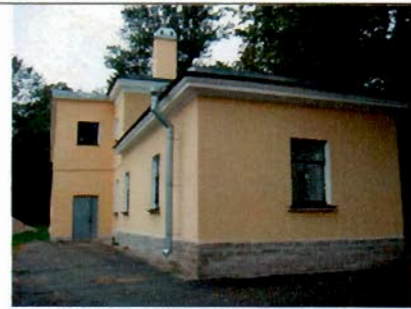
2. Южный фасад. Фрагмент.
