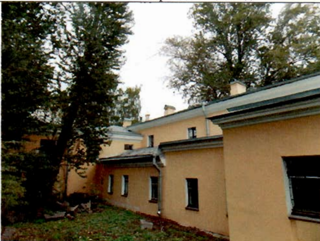
5. Западный фасад. Общий вид.
