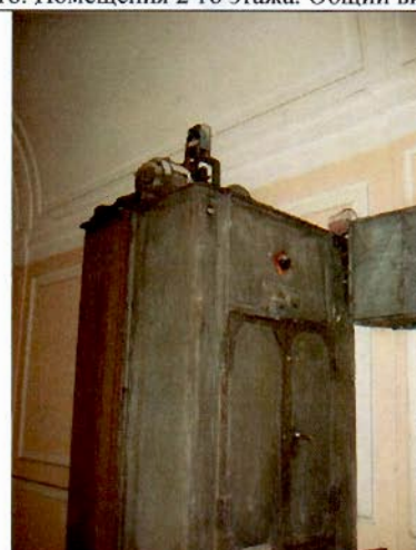
20. Лифтовая шахта. Фрагмент.
