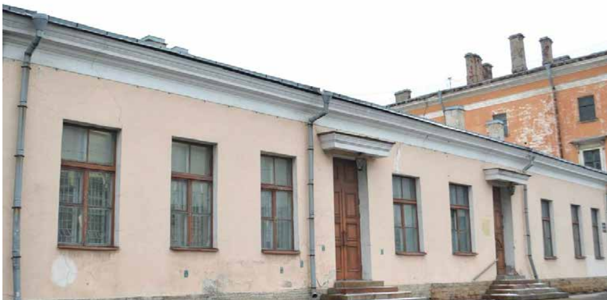
Фото 2.1. Духовная академия. Больничный флигель (наб. Обводного канала, 7, литер А). Южный фасад. Общий вид. Съёмка 01.12.2021 г.
