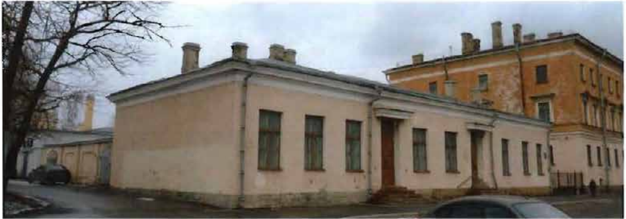
1. Объект культурного наследия. Общий вид с юго-запада.
