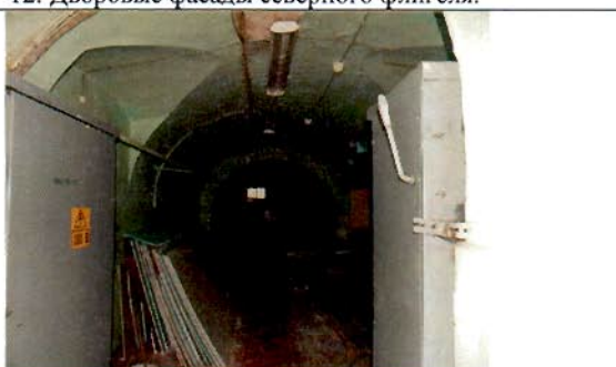
14. Коридор в уровне подвала. Общий вид.
