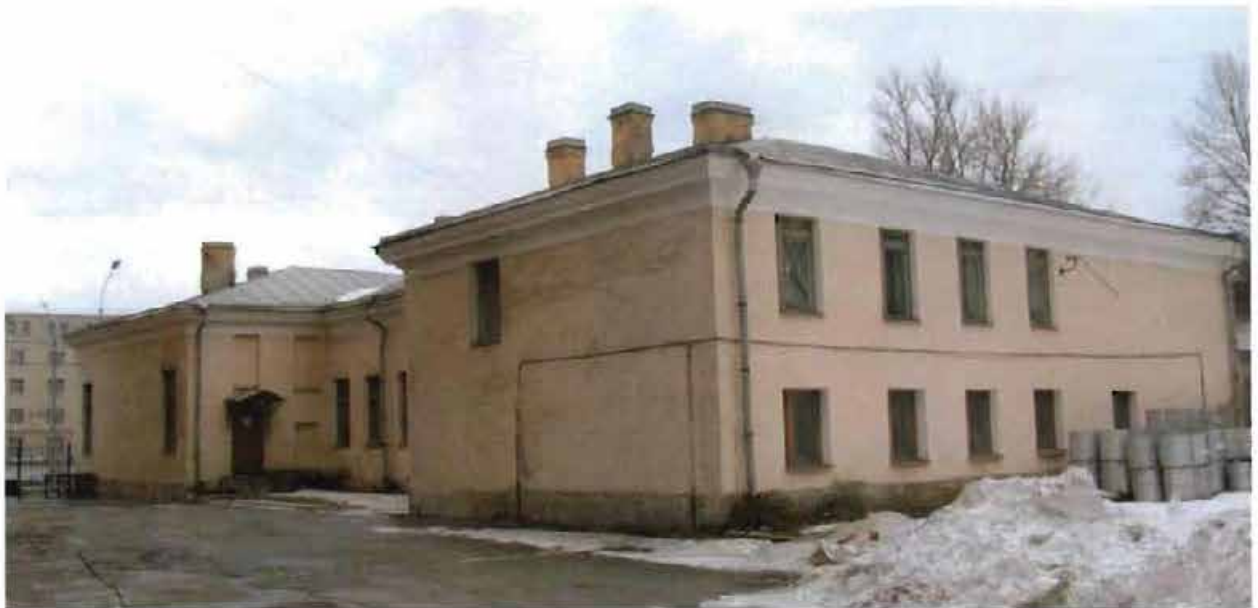
2. Общий вид с северо-востока. Дворовые фасады.
