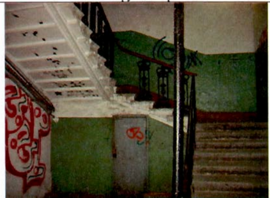
28. Лестница в южной части здания. Общий вид.
