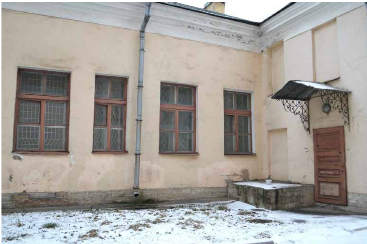
Фото 2.9. Духовная академия. Больничный флигель (наб. Обводного канала, 7, литер А). Восточный фасад. Фрагмент. Съёмка 01.12.2021 г.
