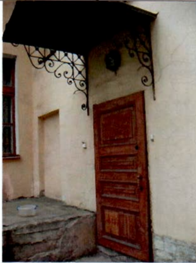
3. Дверной проем восточного фасада.
