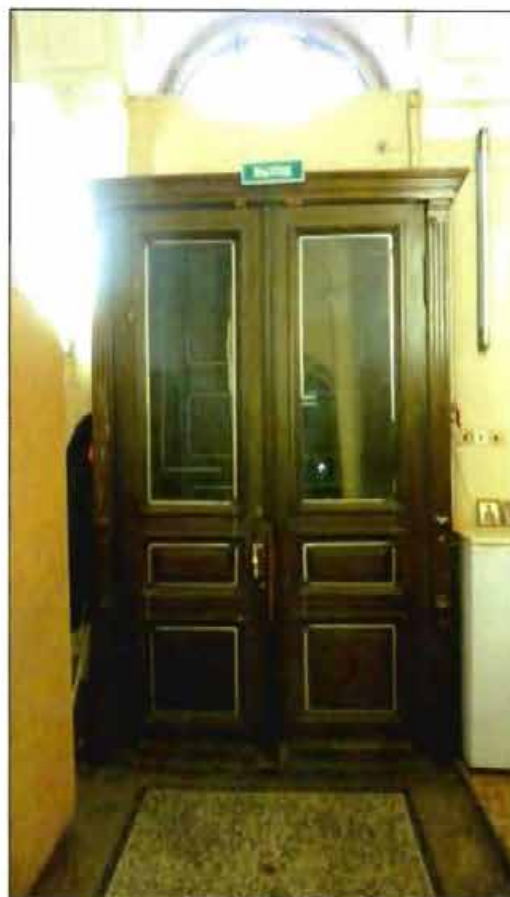
11. Деревянный тамбур (пом. 1-Н (1)).
