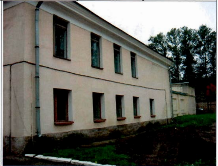
4. Северный фасад. Общий вид.
