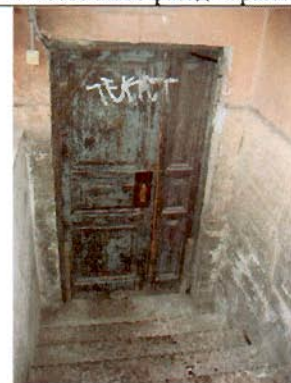
6. Входной проем восточного фасада. Общий вид.
