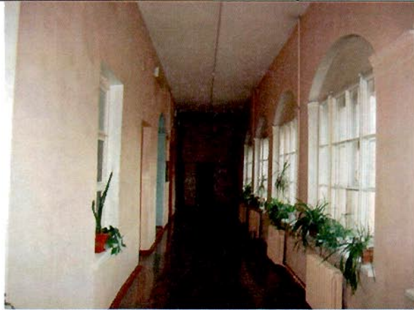
26. Коридор в уровне 3-го этажа. Общий вид.
