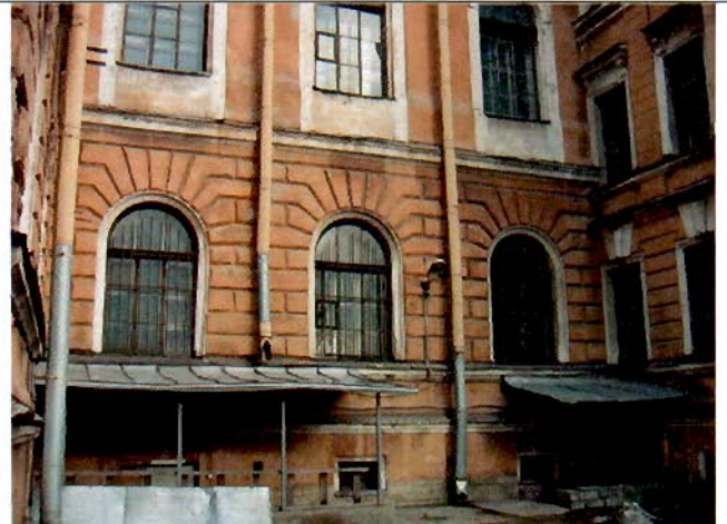
12. Западный фасад. Фрагмент.
