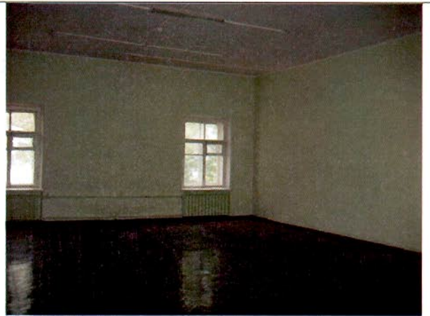
25. Помещения в уровне 2-го этажа. Общий вид.
