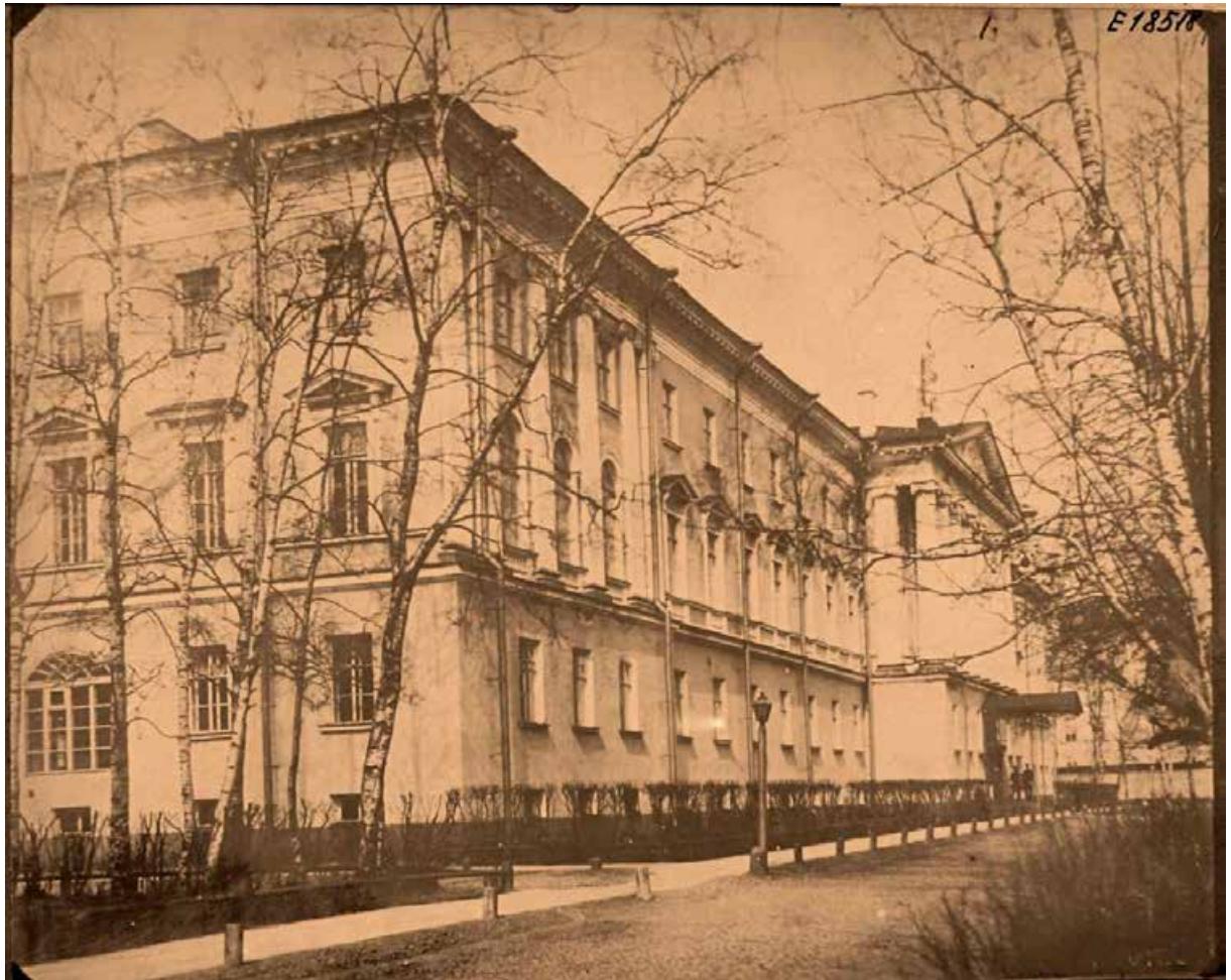
Илл. 23. Главный и южный фасады здания Духовной Академии. 1910-е гг.
