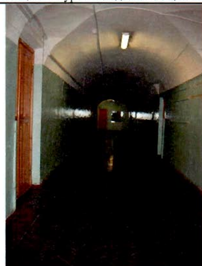
17. Коридор 1-го этажа. Общий вид.
