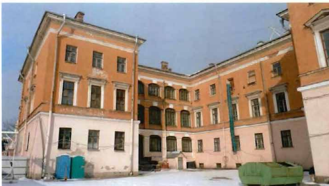
5. Объект культурного наследия. Дворовые фасады. Северный флигель. Вид с юга.
