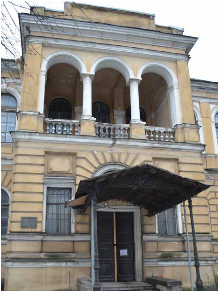
Фото 3.12. Духовная академия. Библиотека (наб. Обводного канала, 11, литер А). Северный фасад. Фрагмент. Съёмка 01.12.2021 г.
