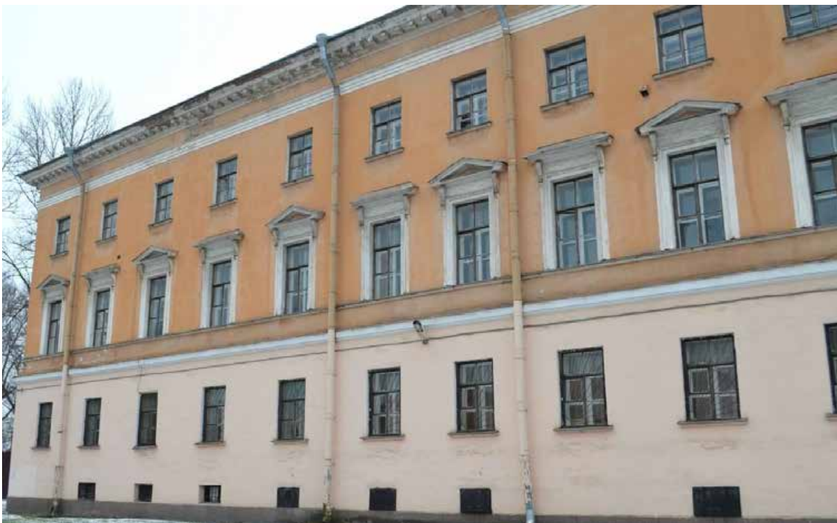
Фото 1.9. Духовная академия. Главное здание (наб. Обводного канала, 7, литер Г). Северный фасад. Фрагмент. Съёмка 01.12.2021 г.
