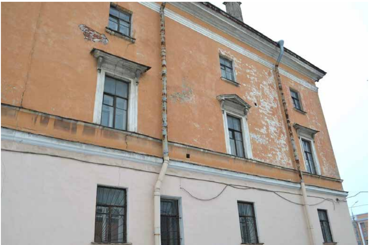
Фото 1.25. Духовная академия. Главное здание (наб. Обводного канала, 7, литер Г). Западный дворовый фасад. Оконные проёмы в уровне первого, второго и третьего этажей. Фрагмент. Съёмка 01.12.2021 г.
