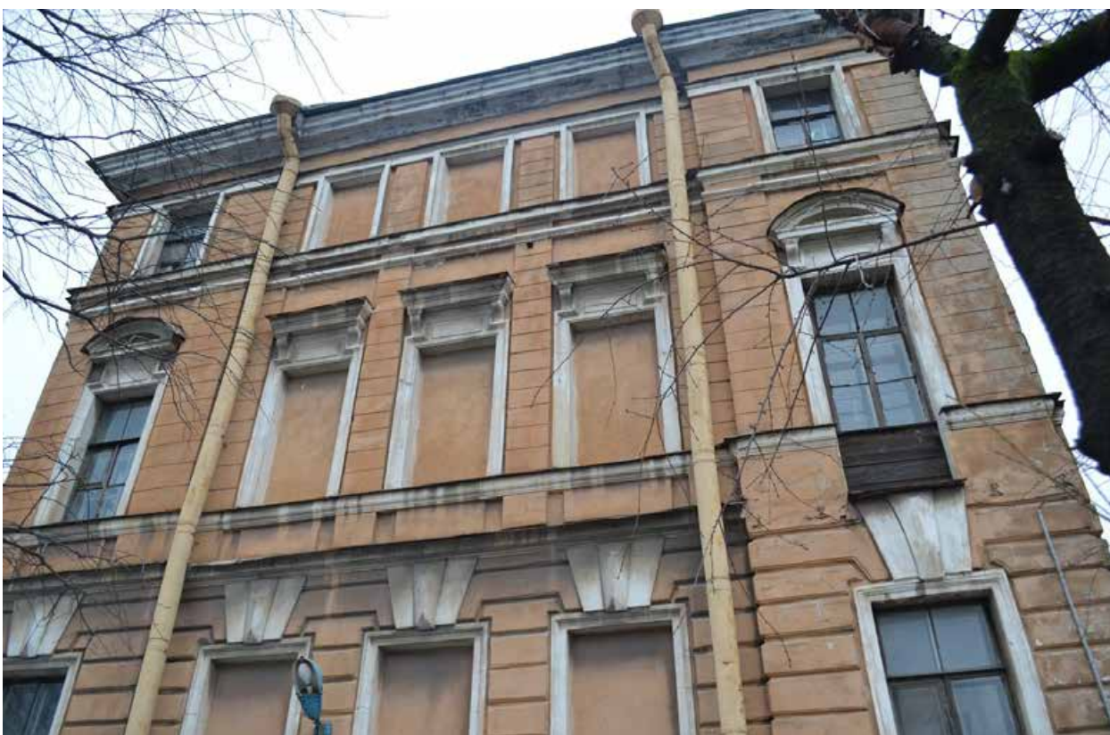
Фото 3.5. Духовная академия. Библиотека (наб. Обводного канала, 11, литер А). Западный фасад. Фрагмент. Съёмка 01.12.2021 г.
