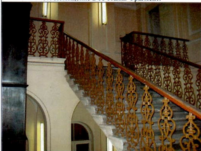
19. Лестница северной части здания. Общий вид.
