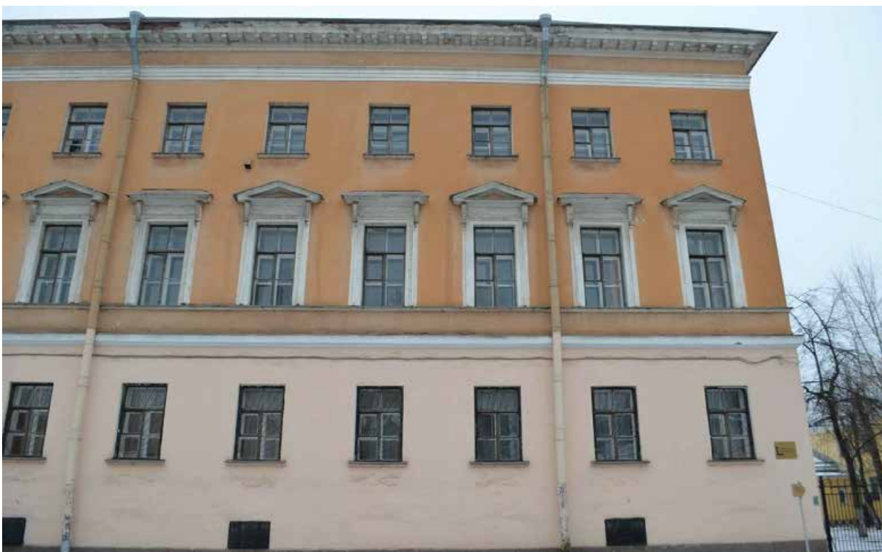
Фото 1.10. Духовная академия. Главное здание (наб. Обводного канала, 7, литер Г). Северный фасад. Фрагмент. Съёмка 01.12.2021 г.
