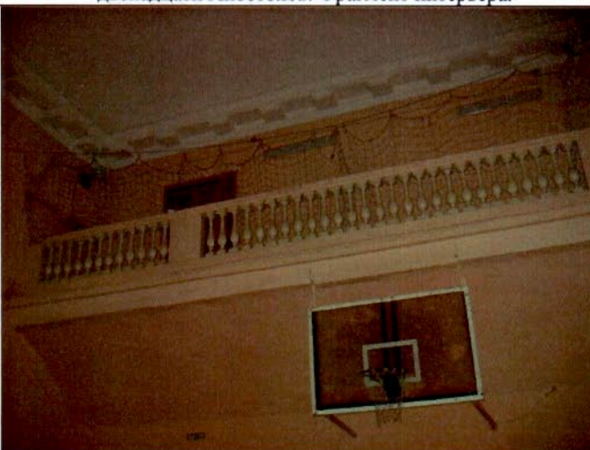
34. Помещение 3-Н (111) бывшего Актового зала. Балкон в уровне 2-го света.
