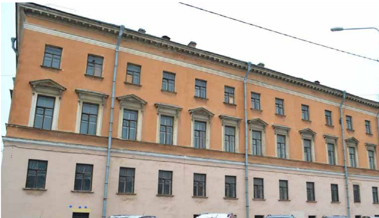
Фото 1.27. Духовная академия. Главное здание (наб. Обводного канала, 7, литер Г). Южный фасад. Общий вид. Съёмка 01.12.2021 г.
