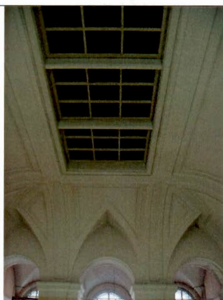
18. Помещения 2-го этажа. Общий вид.
