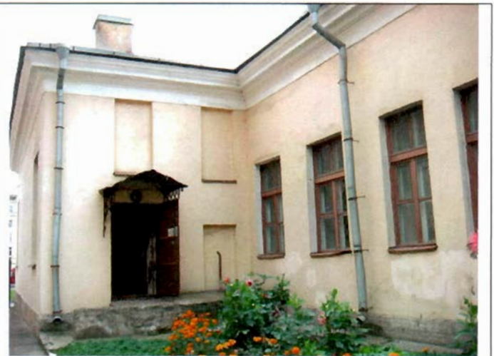
2. Фрагмент восточного фасада.
