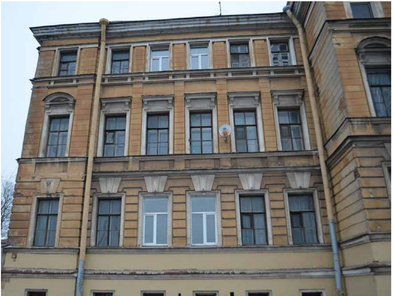
Фото 3.3. Духовная академия. Библиотека (наб. Обводного канала, 11, литер А). Южный фасад. Фрагмент. Съёмка 01.12.2021 г.
