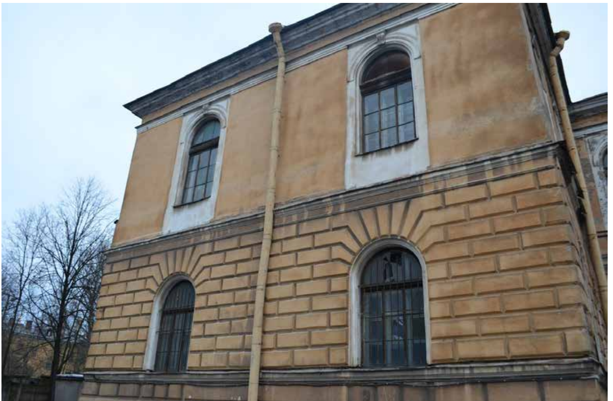
Фото 3.8. Духовная академия. Библиотека (наб. Обводного канала, 11, литер А). Западный фасад. Фрагмент. Съёмка 01.12.2021 г.
