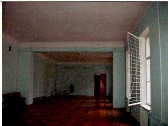
28. Помещение 2-го этажа. Общий вид.
