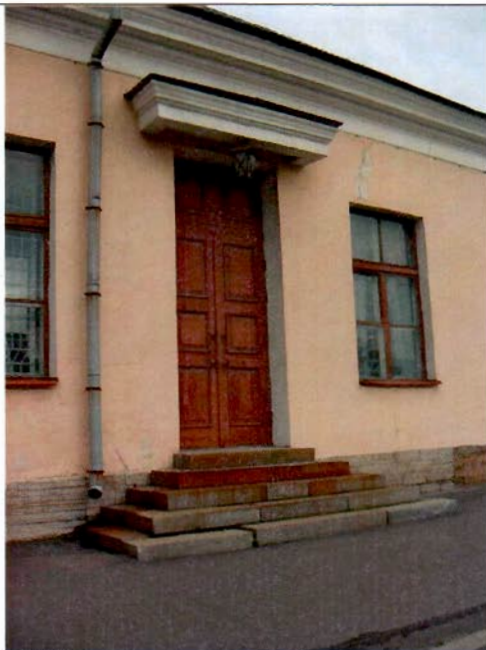
7. Дверное заполнение. Южный фасад.
