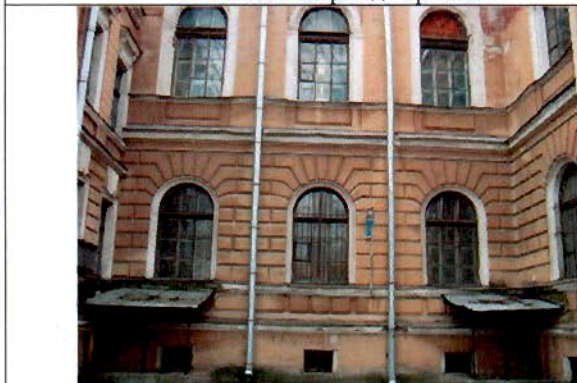
5. Восточный фасад. Фрагмент.
