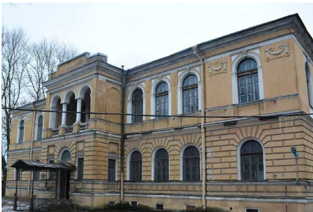
Фото 3.10. Духовная академия. Библиотека (наб. Обводного канала, 11, литер А). Северный фасад. Общий вид. Съёмка 01.12.2021 г.
