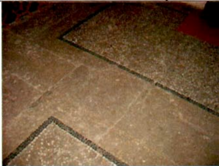
23. Напольное покрытие помещений. Фрагмент.
