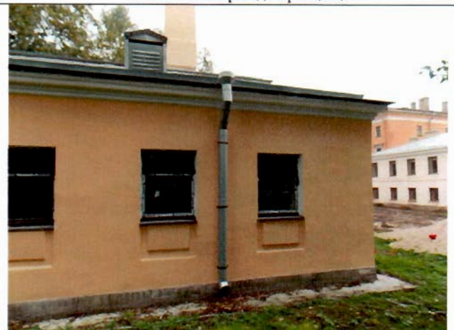
6. Западный фасад. Фрагмент.
