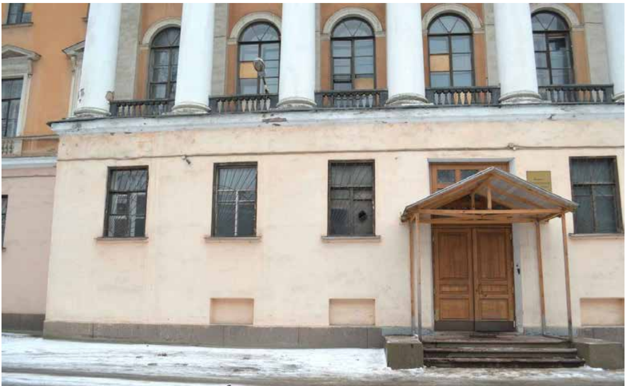
Фото 1.5. Духовная академия. Главное здание (наб. Обводного канала, 7, литер Г). Восточный фасад. Центральное крыльцо. Оконные проёмы в уровне первого и второго этажей. Фрагмент. Съёмка 01.12.2021 г.
