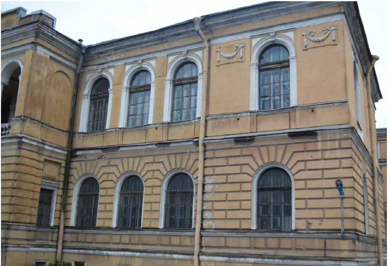
Фото 3.11. Духовная академия. Библиотека (наб. Обводного канала, 11, литер А). Северный фасад. Фрагмент. Съёмка 01.12.2021 г.
