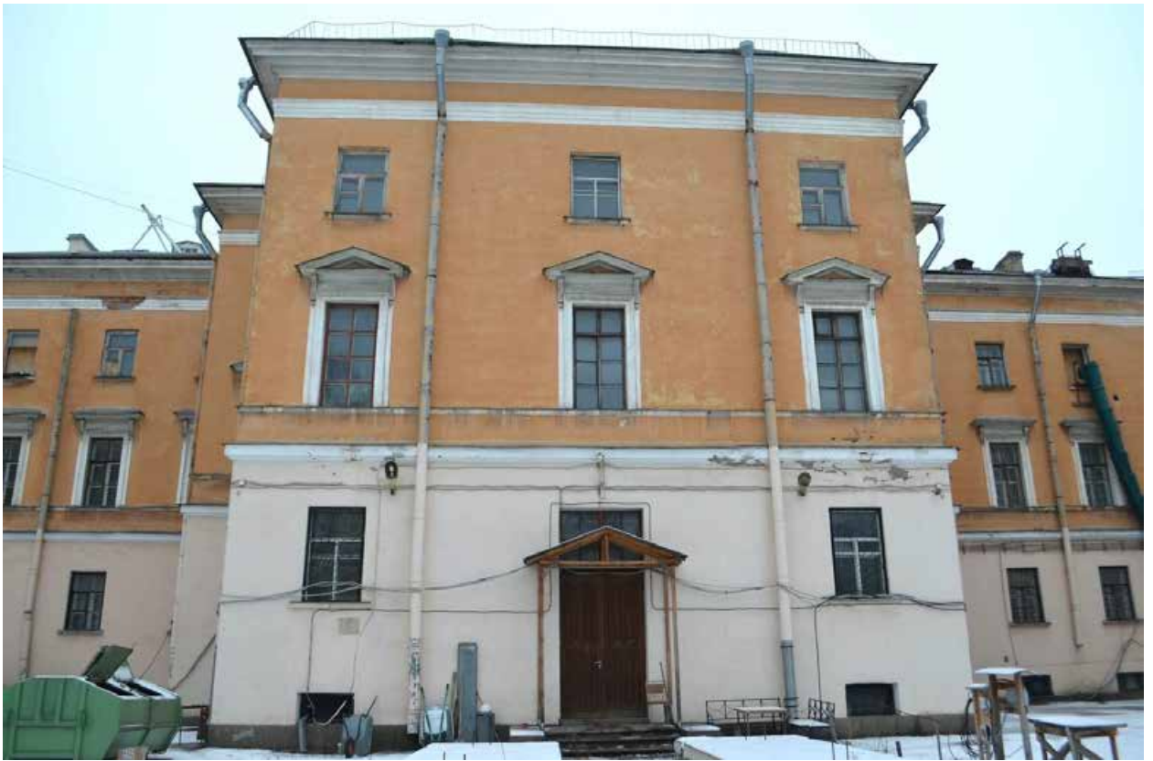
Фото 1.19. Духовная академия. Главное здание (наб. Обводного канала, 7, литер Г). Западный дворовый фасад. Центральное крыльцо. Общий вид. Съёмка 01.12.2021 г.
