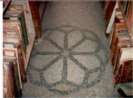
24. Напольное покрытие помещений. Фрагмент.
