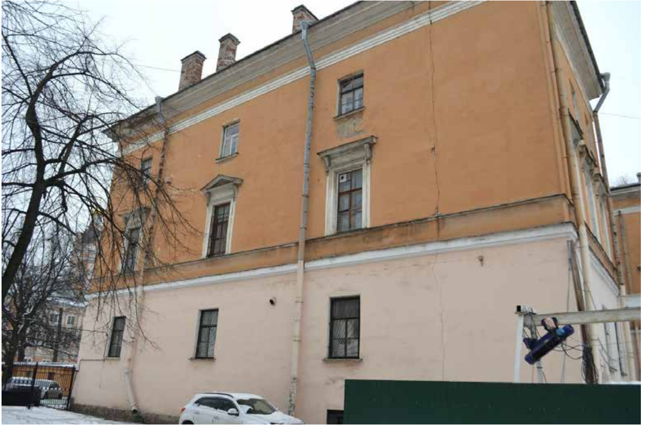
Фото 1.13. Духовная академия. Главное здание (наб. Обводного канала, 7, литер Г). Западный дворовый фасад. Фрагмент. Съёмка 01.12.2021 г.
