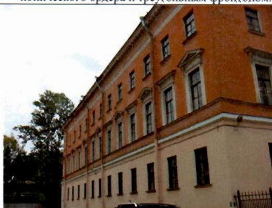
6. Северный фасад. Общий вид.
