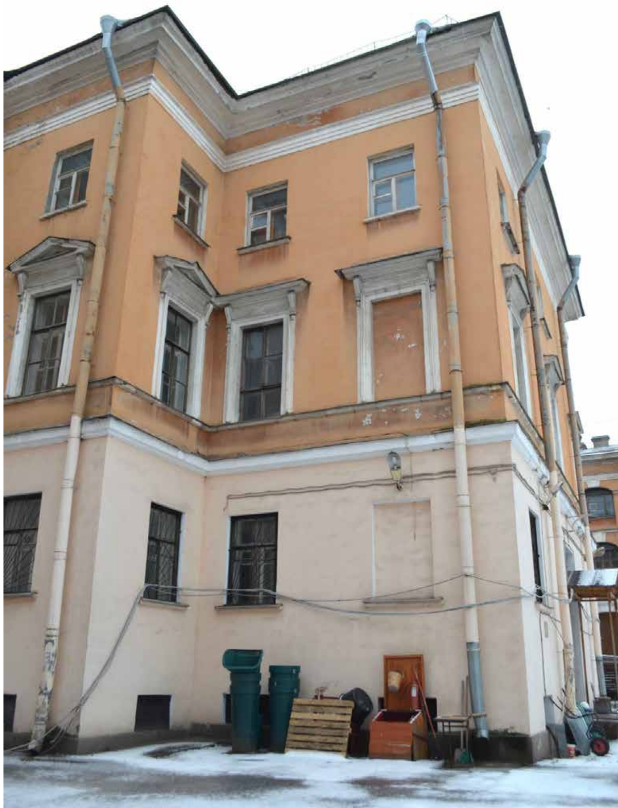
Фото 1.18. Духовная академия. Главное здание (наб. Обводного канала, 7, литер Г). Западный дворовый фасад. Фрагмент. Съёмка 01.12.2021 г.
