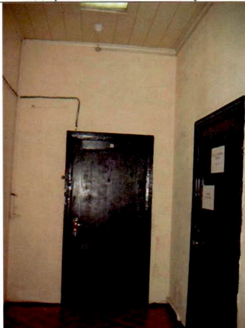
9. Коридор 1-го этажа.
