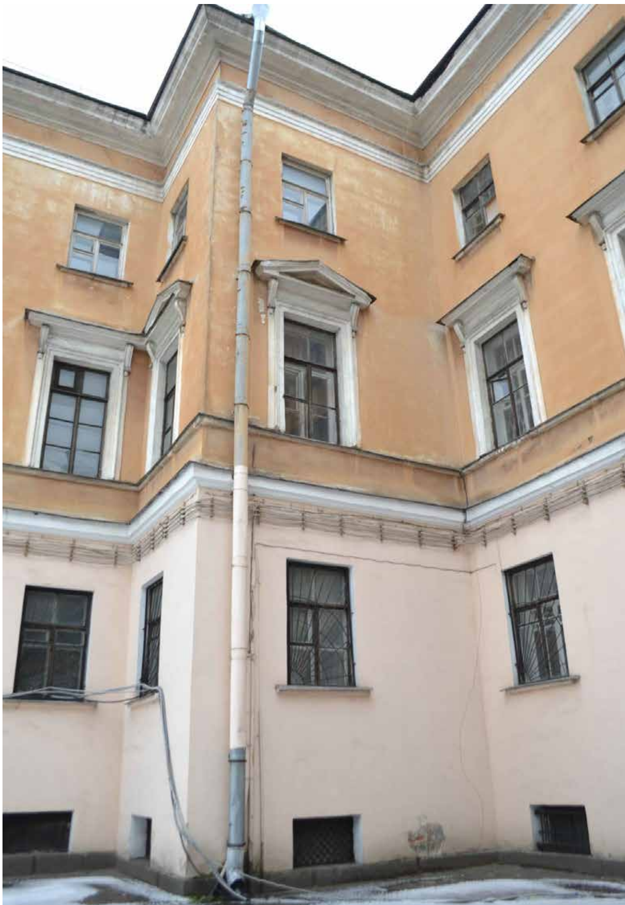
Фото 1.21. Духовная академия. Главное здание (наб. Обводного канала, 7, литер Г). Западный дворовый фасад. Фрагмент. Съёмка 01.12.2021 г.
