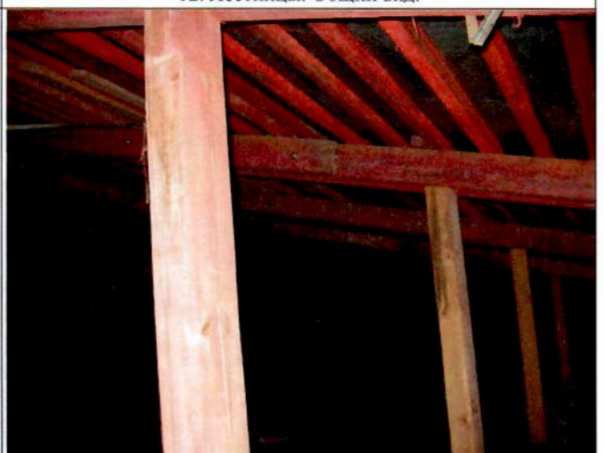
14. Конструкции крыши. Общий вид.
