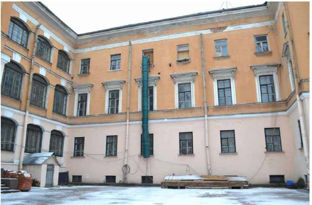
Фото 1.16. Духовная академия. Главное здание (наб. Обводного канала, 7, литер Г). Западный дворовый фасад. Фрагмент. Съёмка 01.12.2021 г.
