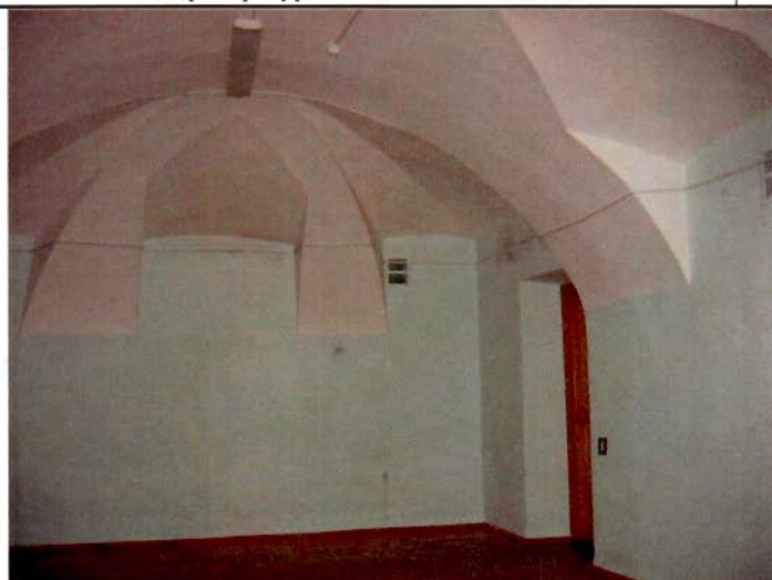
16. Помещения 1-го этажа. Общий вид.
