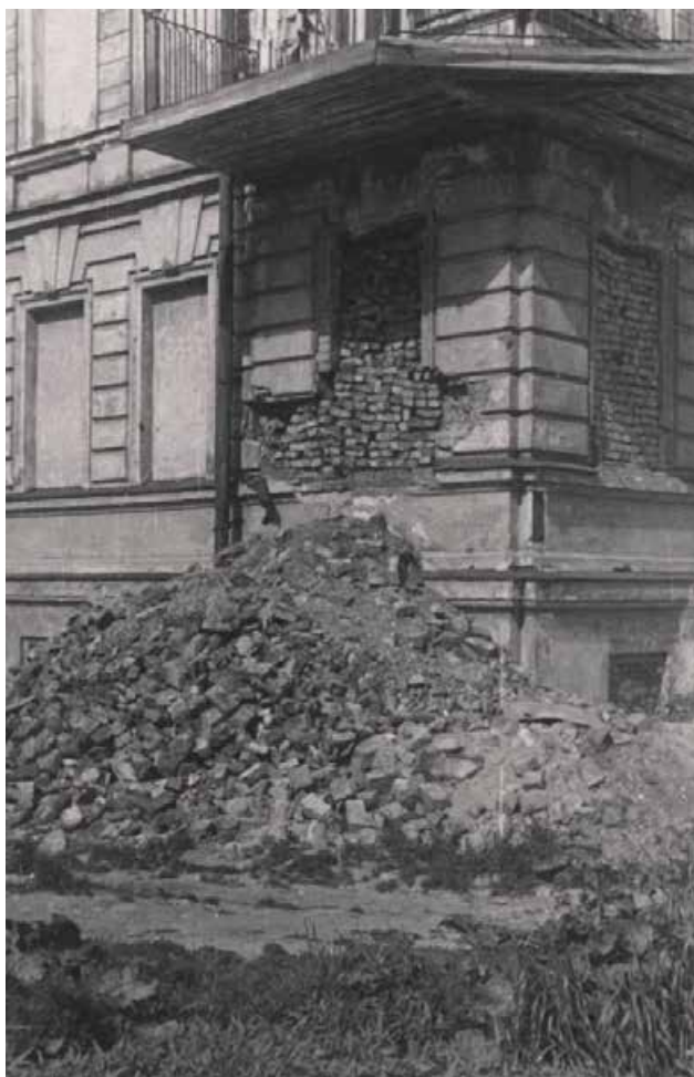
Илл. 19. Полуразрушенный ДОТ у юго-западного угла здания. 1944 г.
