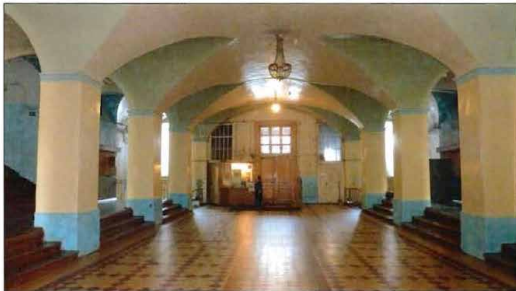
10. Вестибюль (пом. 3-Н (2)).
