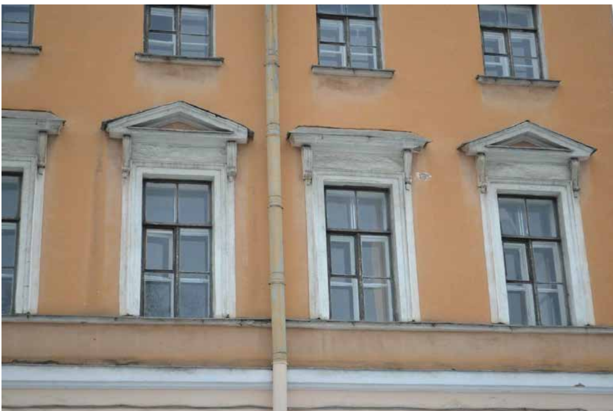
Фото 1.12. Духовная академия. Главное здание (наб. Обводного канала, 7, литер Г). Северный фасад. Оконные проёмы в уровне второго этажа. Фрагмент. Съёмка 01.12.2021 г.
