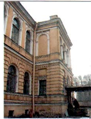
8. Северный фасад. Фрагмент.
