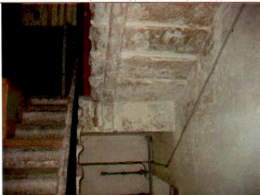
27. Лестница в западной части здания. Общий вид.
