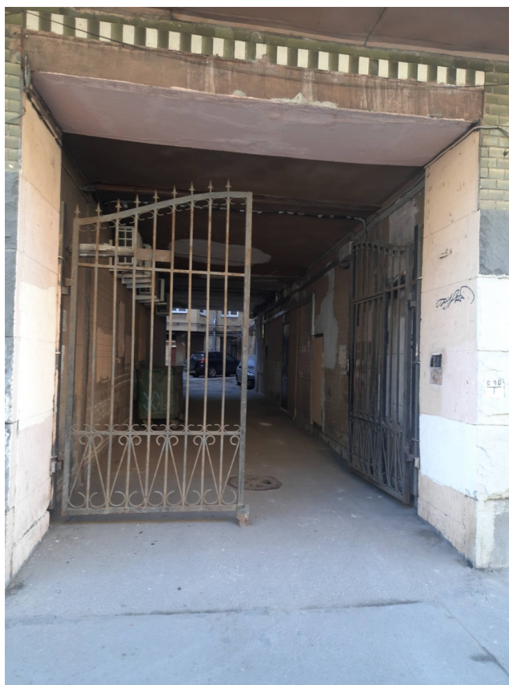
Фото 2 Лицевой фасад выявленного объекта культурного наследия «Дом Н.И. Алексеева», воротный проезд
