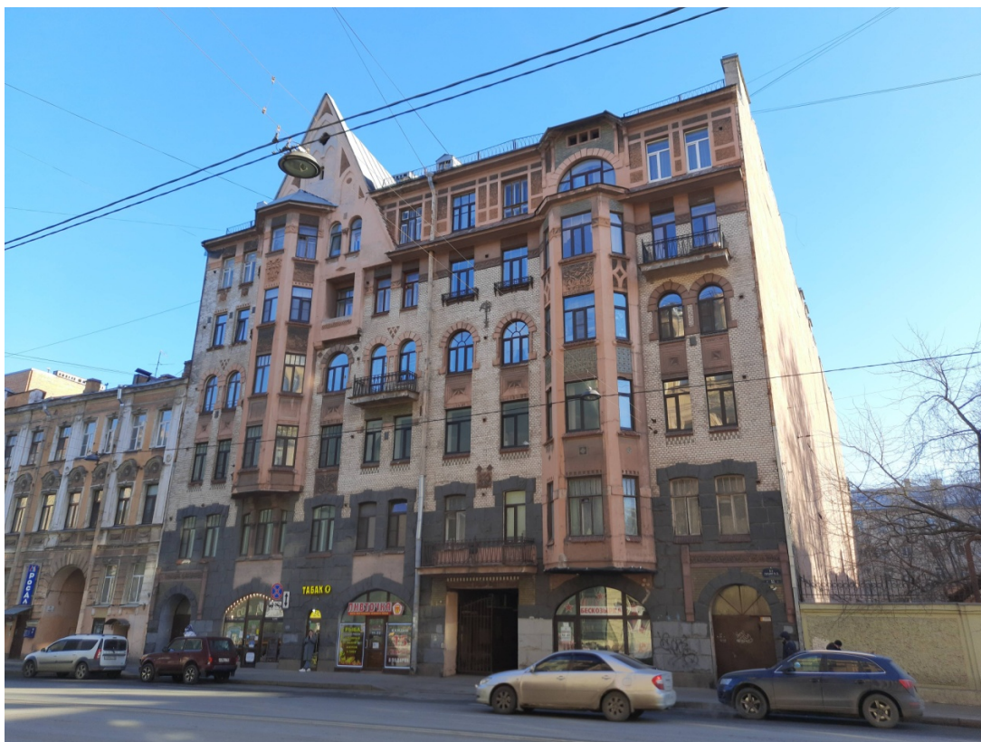
Фото 1 Лицевой фасад выявленного объекта культурного наследия «Дом Н.И. Алексеева»
