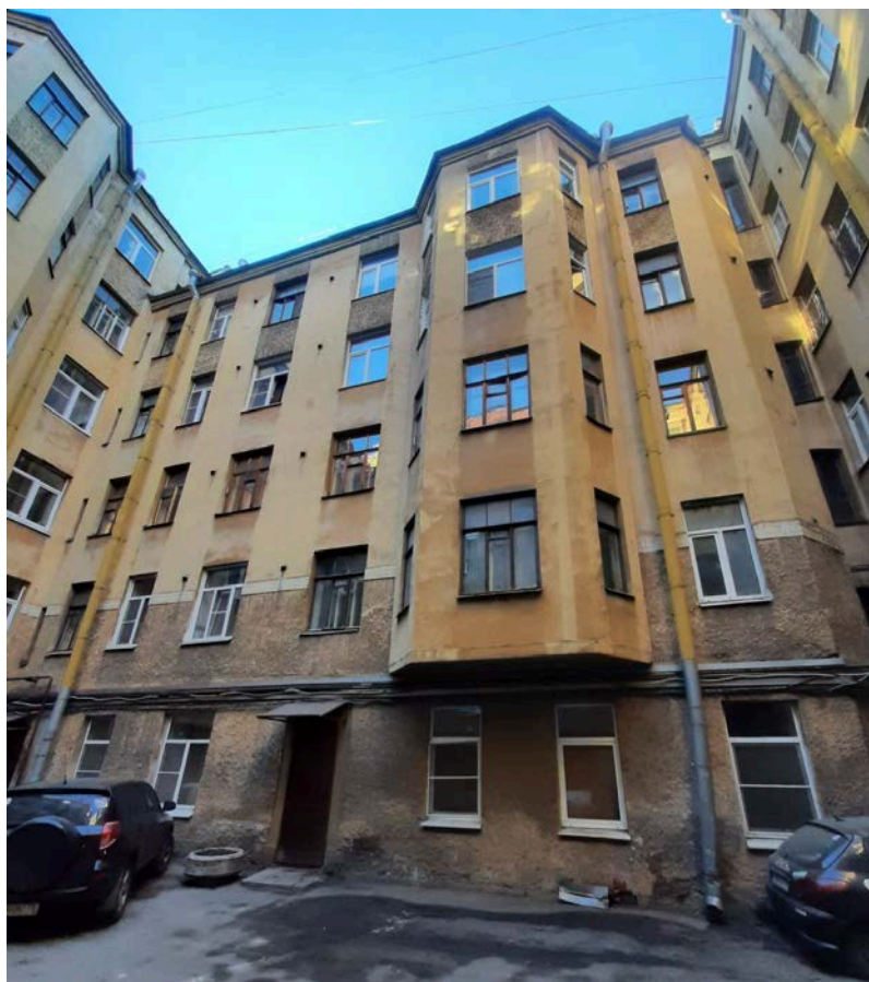
Фото 5 Фрагмент дворового фасада выявленного объекта культурного наследия «Дом Н.И. Алексеева»
