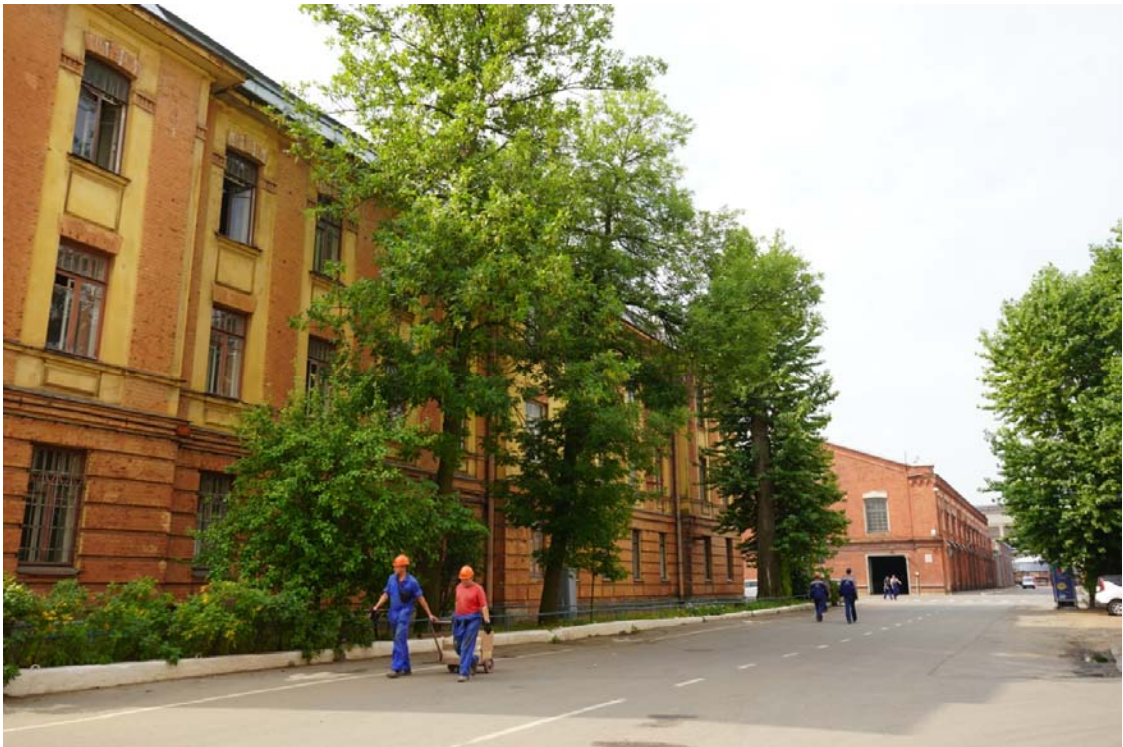
18. Территория проектирования объекта «Строительство трубообрабатывающего комплекса АО «Балтийский завод». Вид на проезд, выявленные объекты культурного наследия «Служебный корпус» и «Медницкая мастерская», входящие в «Комплекс сооружений Балтийского судостроительного и механического завода». Направление съемки юго-запад.
