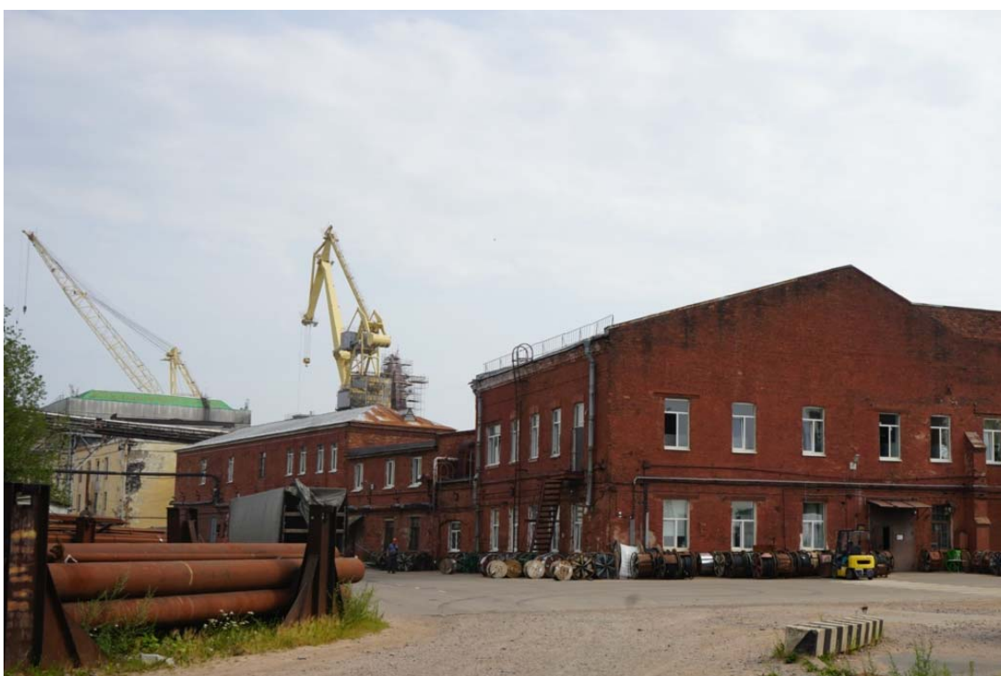
14. Территория проектирования объекта «Строительство трубообрабатывающего комплекса АО «Балтийский завод». Вид на корпуса цехов. Направление съемки восток.
