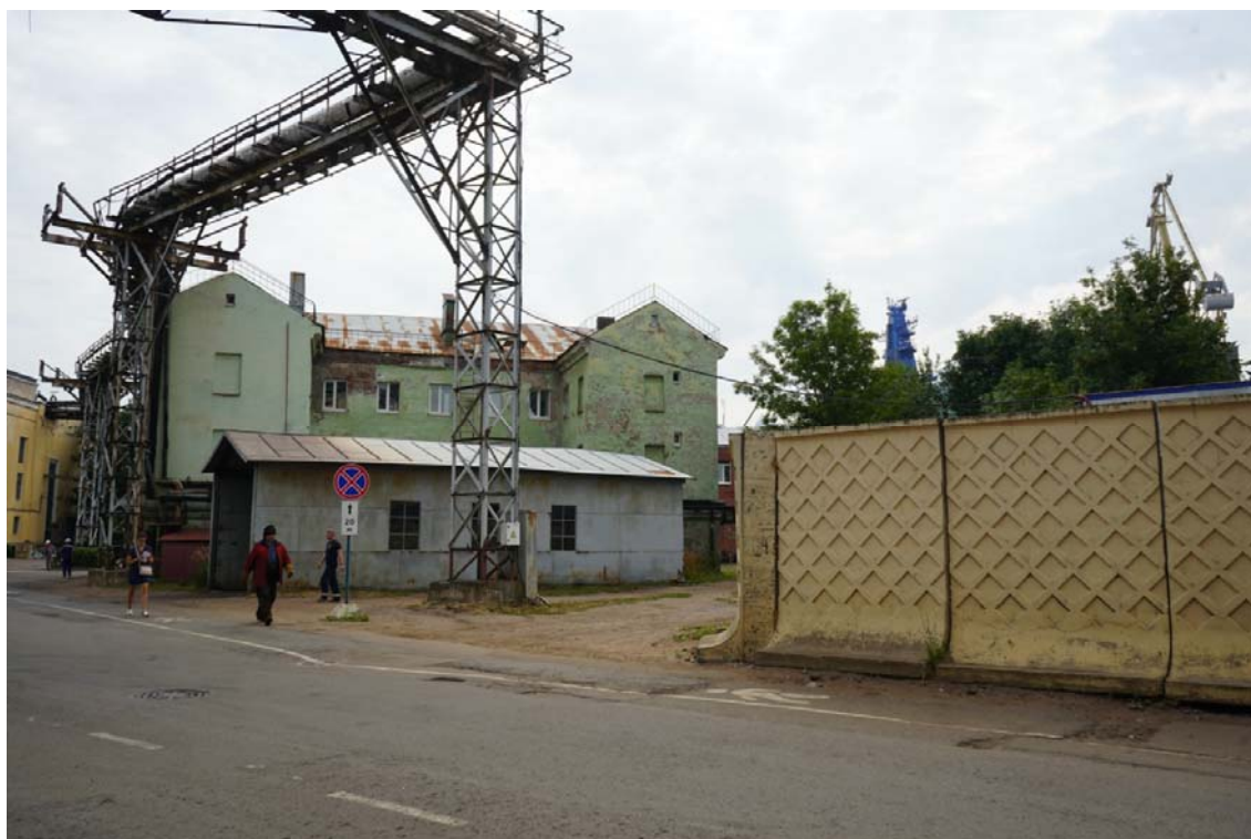
16. Территория проектирования объекта «Строительство трубообрабатывающего комплекса АО «Балтийский завод». Вид на корпуса цехов. Направление съемки восток.
