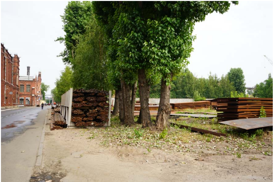
11. Территория проектирования объекта «Строительство трубообрабатывающего комплекса АО «Балтийский завод». Вид на центральный проезд и открытый склад. Направление съемки северо-запад.
