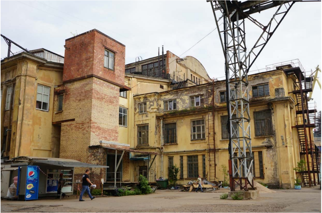
17. Территория проектирования объекта «Строительство трубообрабатывающего комплекса АО «Балтийский завод». Вид на выявленный объект культурного наследия «Производственный корпус» входящий в «Комплекс сооружений Балтийского судостроительного и механического завода». Направление съемки север.
