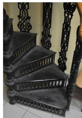
металлическая лестница Л2 – в пом. 1-Н(21)56,0м кв.– винтовая, опора круглого сечения;
