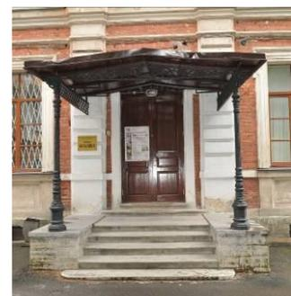
материал – чугун, козырек – двускатный на двух колонках (рисунок – в нижней части граненые, муфтированные, в верхней части растительный орнамент); подзоры – боковые с рисунком «чешуя», фронтальный – рисунок растительного характера;
