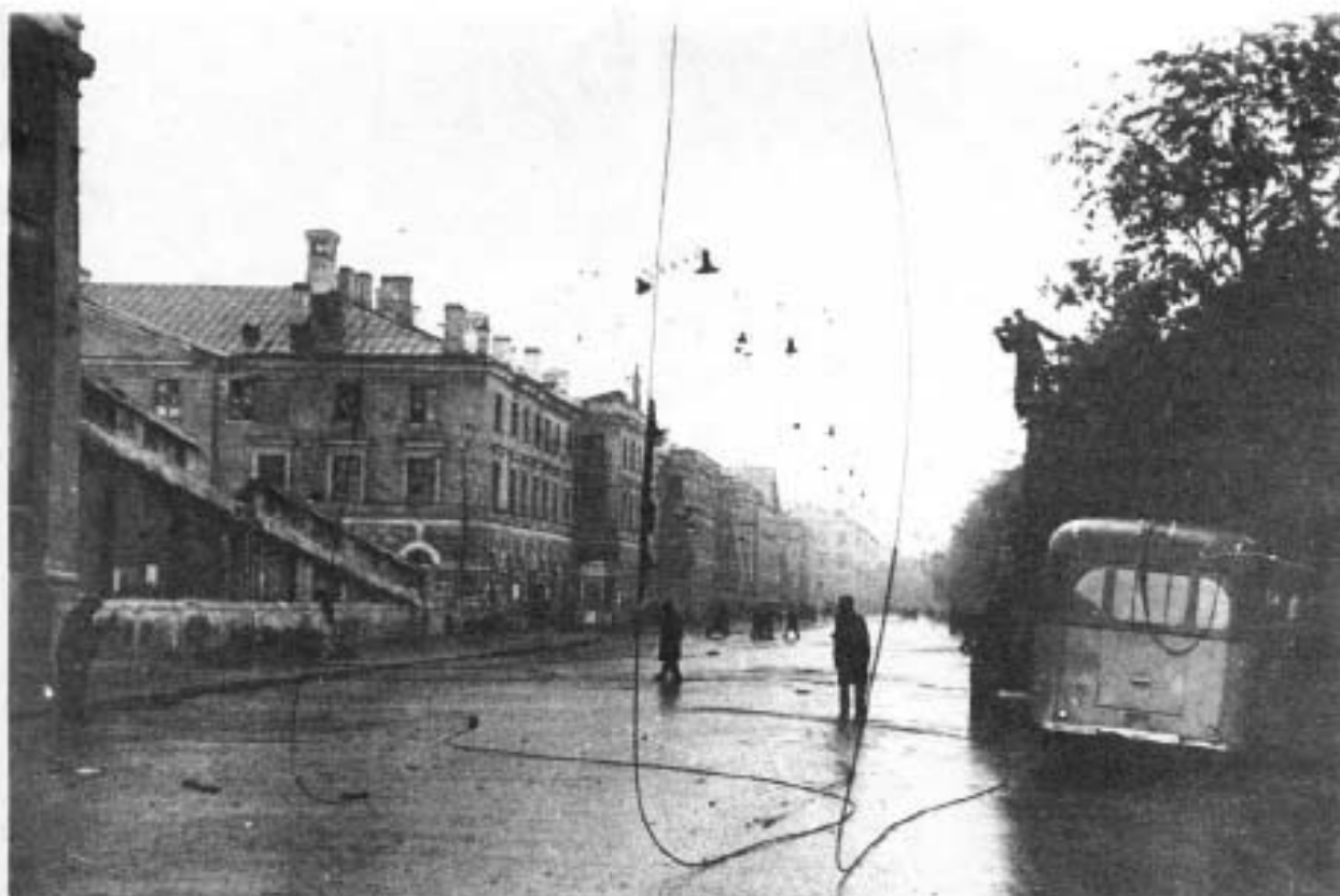
Илл 15. Бульвар Профсоюзов. Контактные провода троллейбусной линии на бульваре Профсоюзов, поврежденные от разрыва артиллерийского снаряда. Автор: Б. Васютинский. Фото 18 сентября 1941 г. - «PastVu» - ретро-фотографии стран и городов [Электронный ресурс]. URL: https://pastvu.com/p/123158
