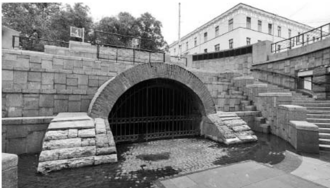
Фото 12. Конногвардейский бульвар, вид на объект культурного наследия регионального значения «Адмиралтейская труба (Подземное гидротехническое сооружение середины - второй половины XIX в.)»
