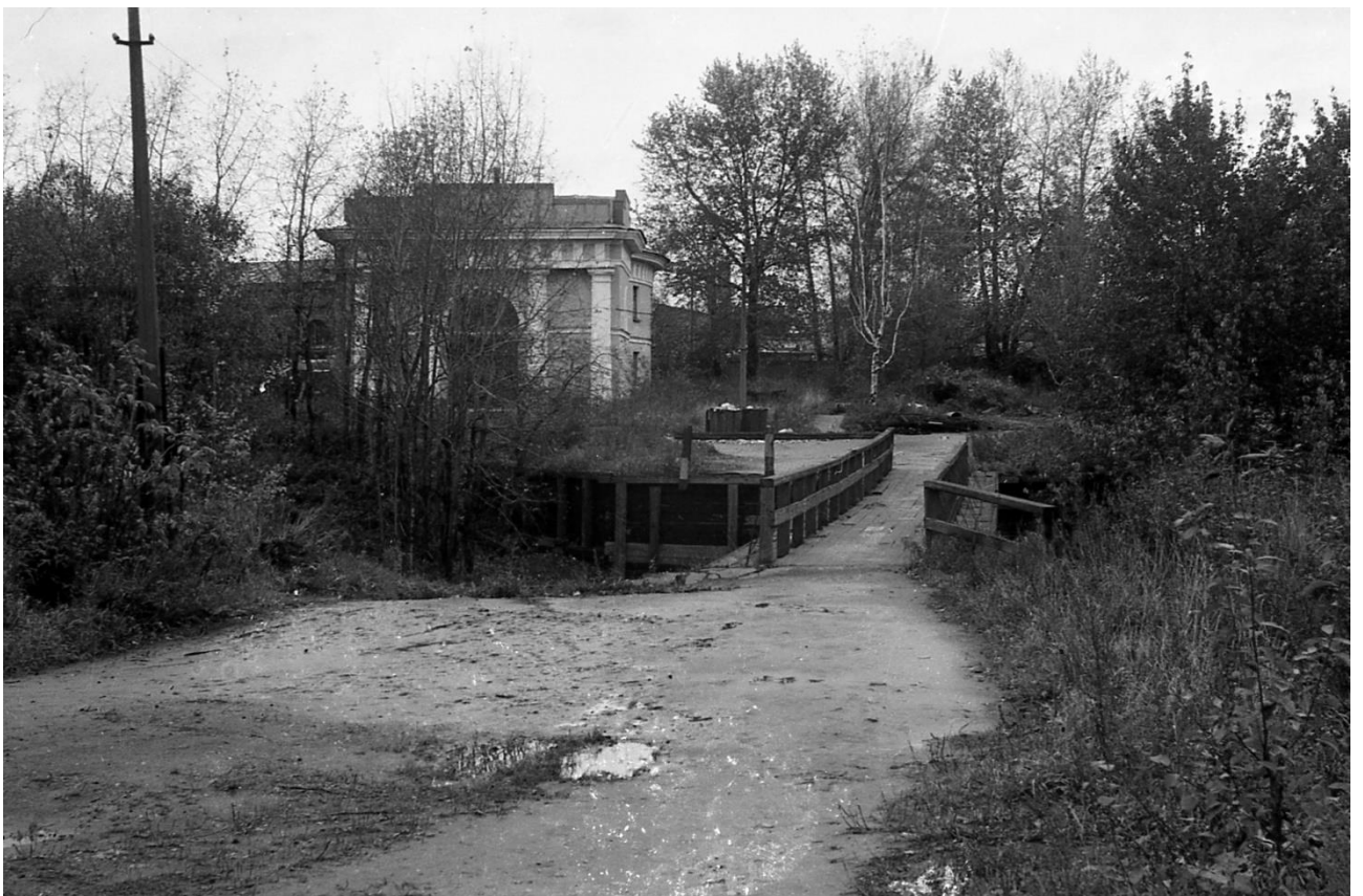
Ил. 36. Уткина дача. Вид на восточную часть служебного корпуса со стороны реки Оккерவில். Фотография 1987 г. Источник: https://pastvu.com/p/123402
