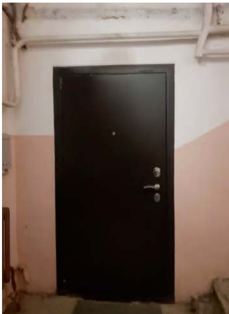
2. Входные дверные заполнения квартиры №86 в уровне 1-го этажа выявленного объекта культурного наследия «Дом С.Д. Шереметева», расположенного по адресу: г. Санкт-Петербург, Литейный проспект, дом 51, литера А. 22.12.2021.
