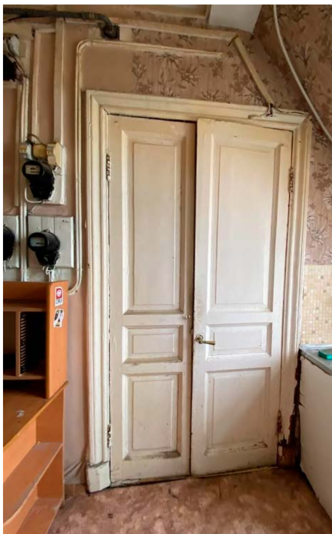
3. Внутренние входные дверные заполнения квартиры №86 в помещении №1 в уровне 1-го этажа выявленного объекта культурного наследия «Дом С.Д. Шереметева», расположенного по адресу: г. Санкт-Петербург, Литейный проспект, дом 51, литера А. 22.12.2021.
