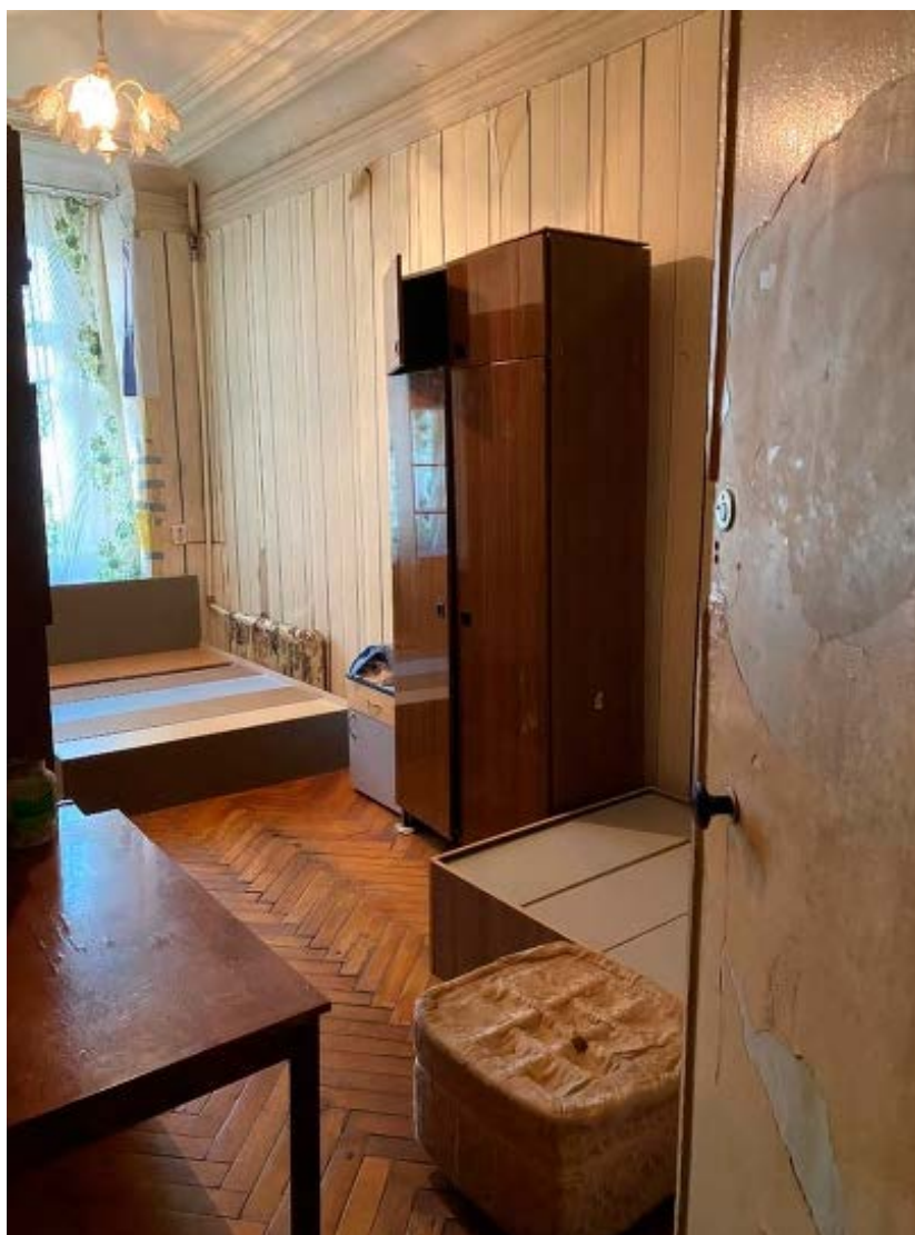
4. Помещения №2 квартиры №86 в уровне 1-го этажа выявленного объекта культурного наследия «Дом С.Д. Шереметева», расположенного по адресу: г. Санкт-Петербург, Литейный проспект, дом 51, литера А. 22.12.2021.
