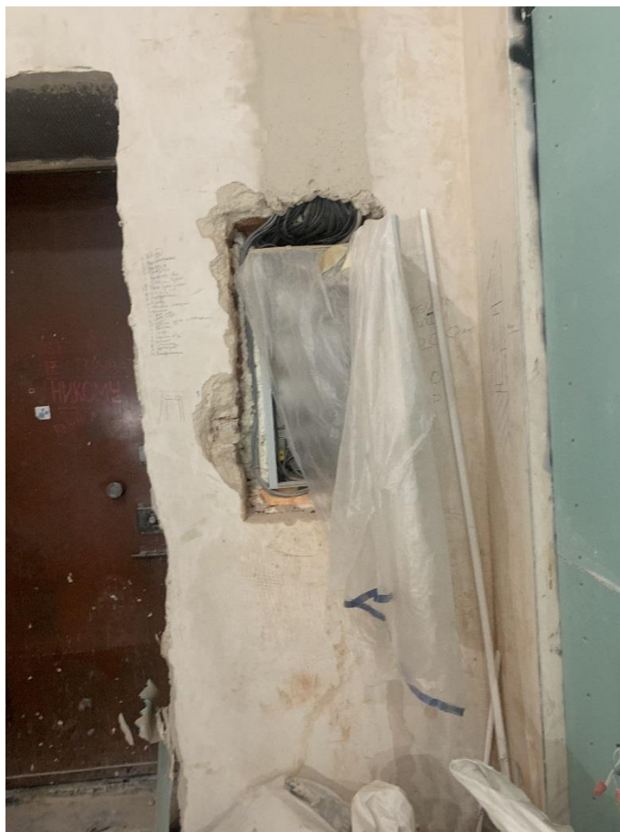
Фото 4. Помещение № 5. Коридор. Вид на входную дверь в квартиру.
