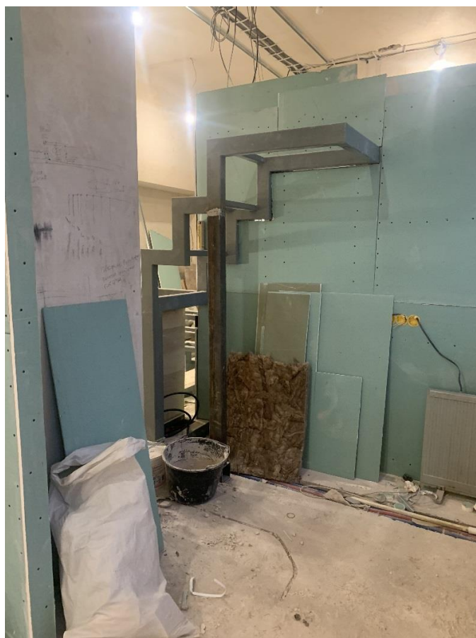
Фото 6. Помещение № 4. Вид от окна.
