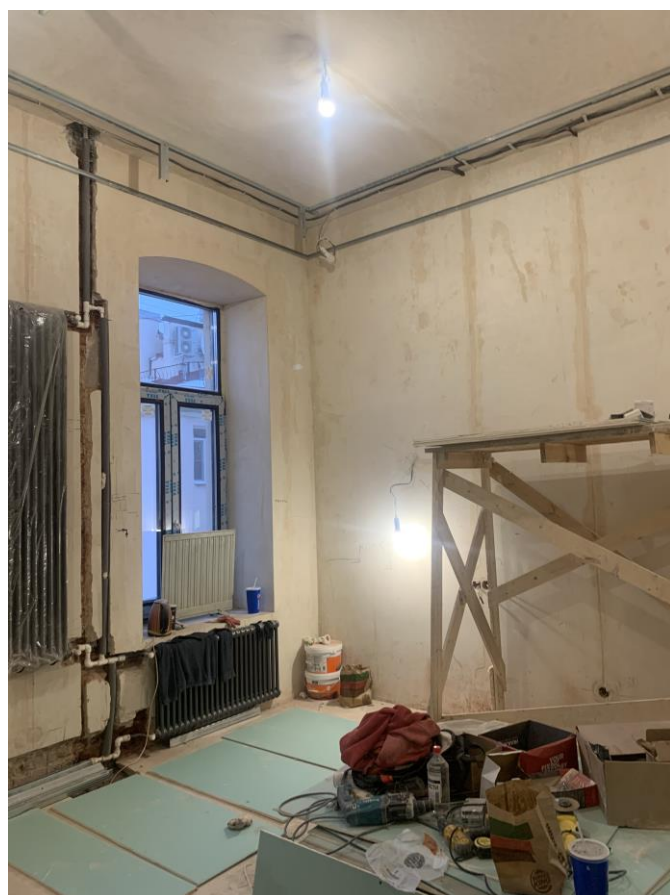
Фото 10. Помещение № 1. Вид на окна.
