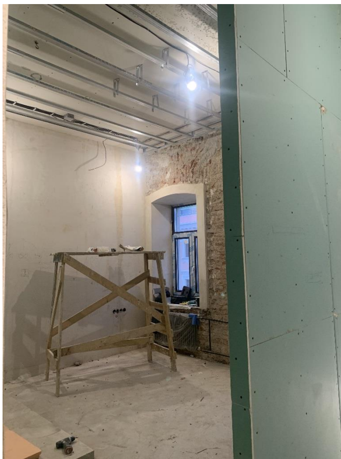
Фото 13. Помещение № 2. Вид из дверного проема.
