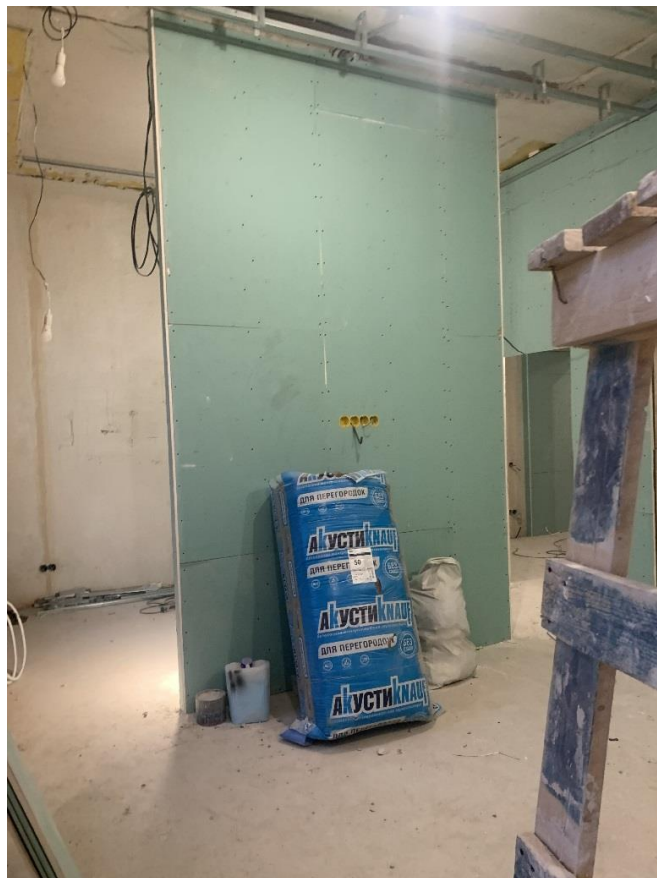
Фото 18. Помещение № 2. Вид на пом. № 3.
