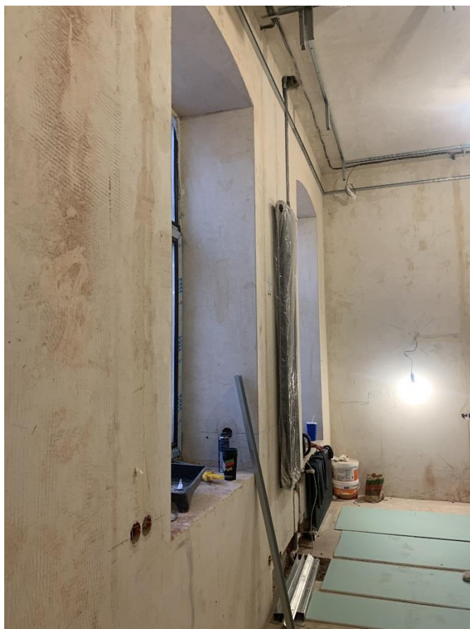
Фото 8. Помещение № 1. Вид на окна.
