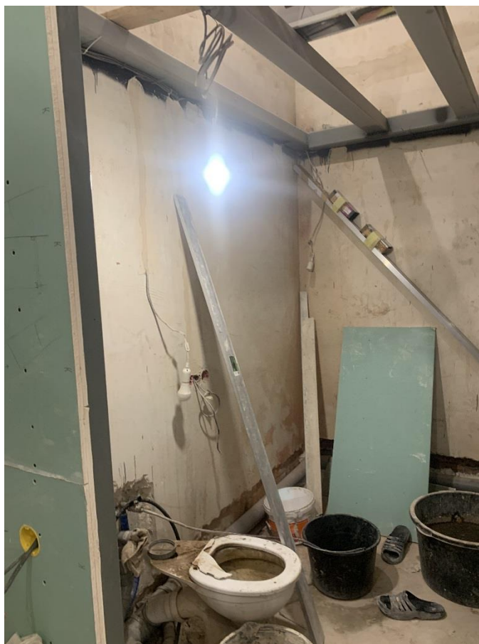
Фото 3. Помещение № 6. Вид со стороны двери.
