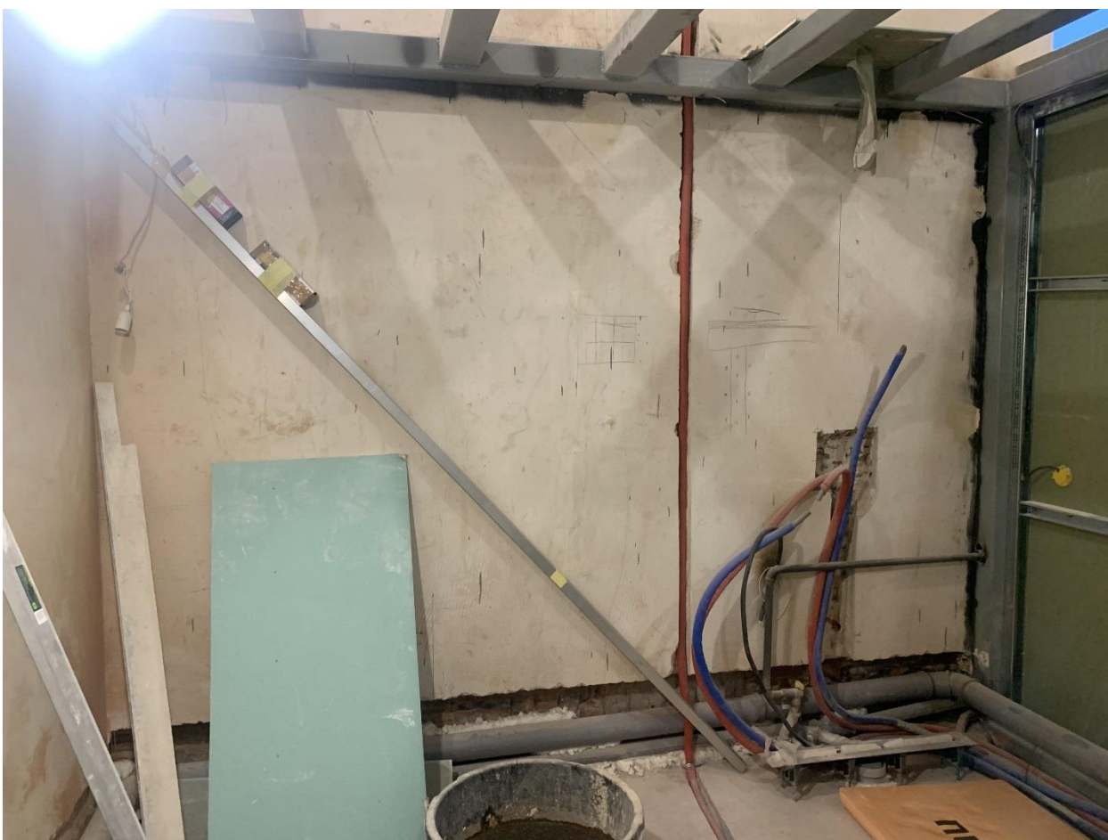
Фото 2. Помещение № 6. Вид со стороны двери.
