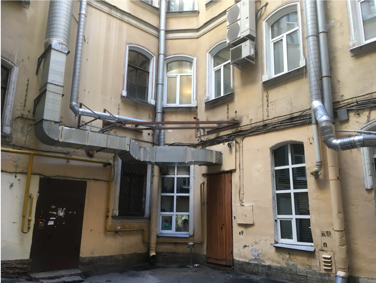
10. «Дом Г.Г.Елисева». Санкт-Петербург, ул. Ломоносовская, д.14, литера А. 2-й двор. Фрагмент дворового фасада. Фото: 10.12.2021.
