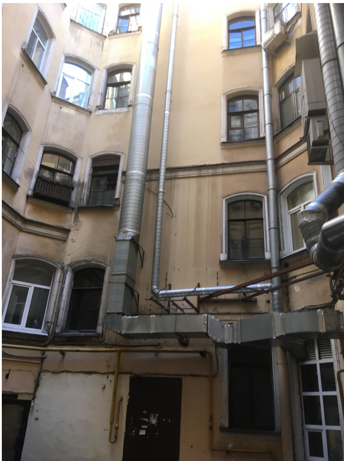
11. «Дом Г.Г.Елисеева». Санкт-Петербург, ул. Ломоносовская, д.14, литера А. 2-й двор. Фрагмент дворового фасада. Фото: 10.12.2021.
