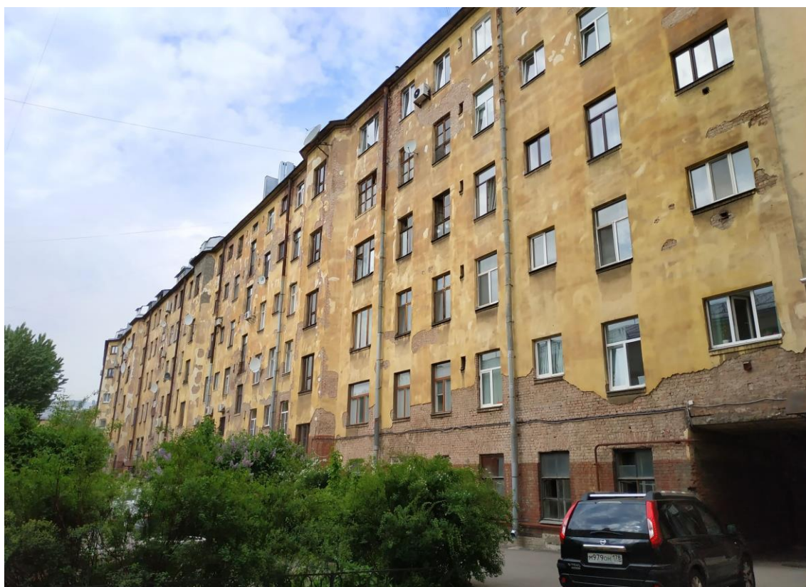
Фото 9. Юго-западный дворовый фасад
