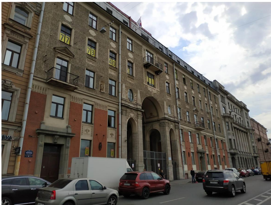
Фото 4. Лицевой фасад по наб. реки Фонтанки
