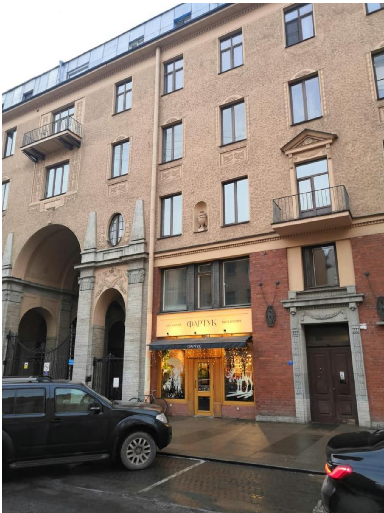
Фото 1. Фрагмент лицевого фасада по ул. Рубинштейна
