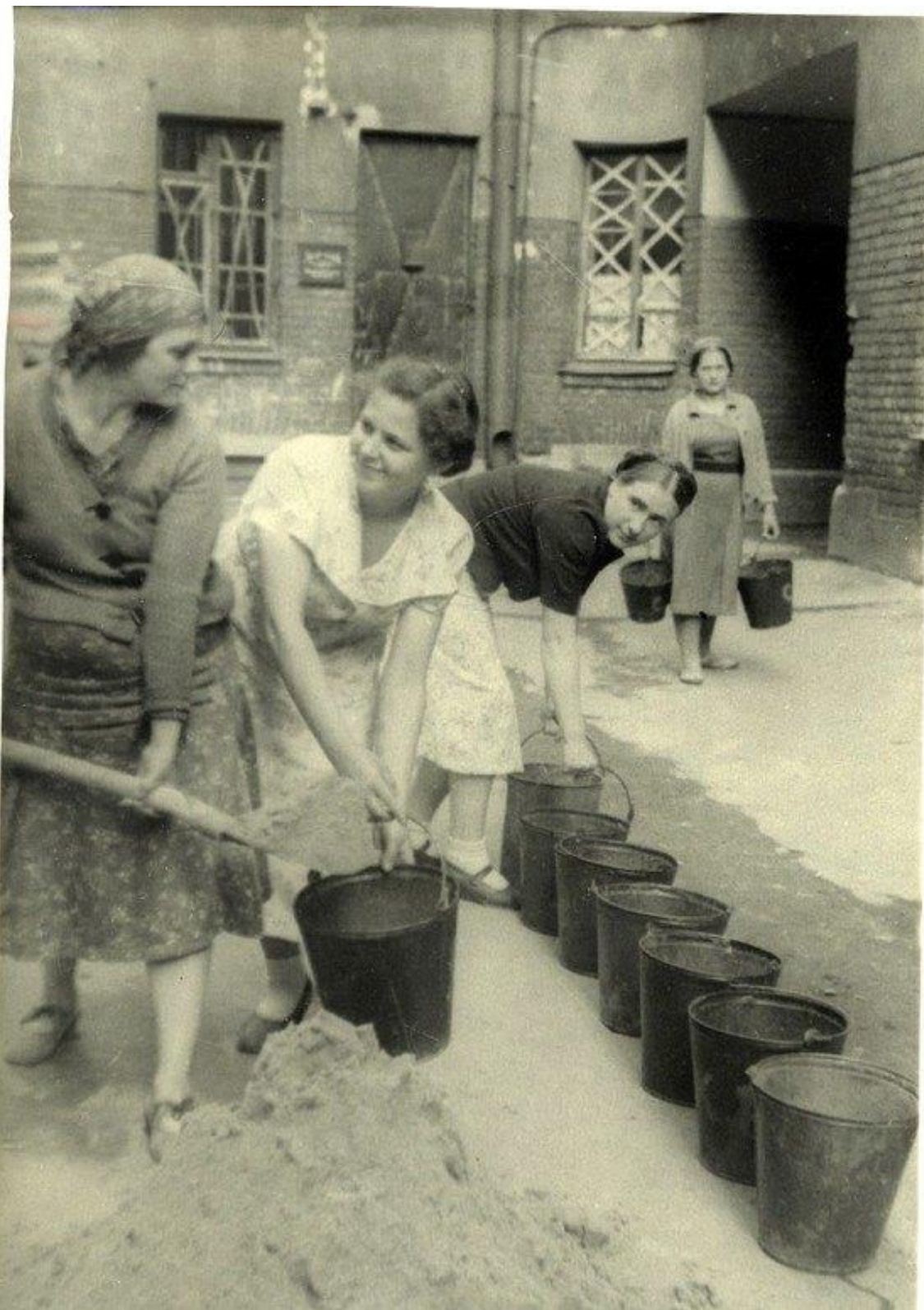
40. Внутренний двор Толстовского дома. Жильцы дома №15/17 по улице Рубинштейна домохозяйки И.П.Рыжова (впереди) и Е.Е.Рыбакова заготавливают песок для тушения зажигательных бомб. 4 июля 1941 г. Автор съемки: В.С. Тарасевич. — ЦГАКФФД СПб, Ар 10010.
