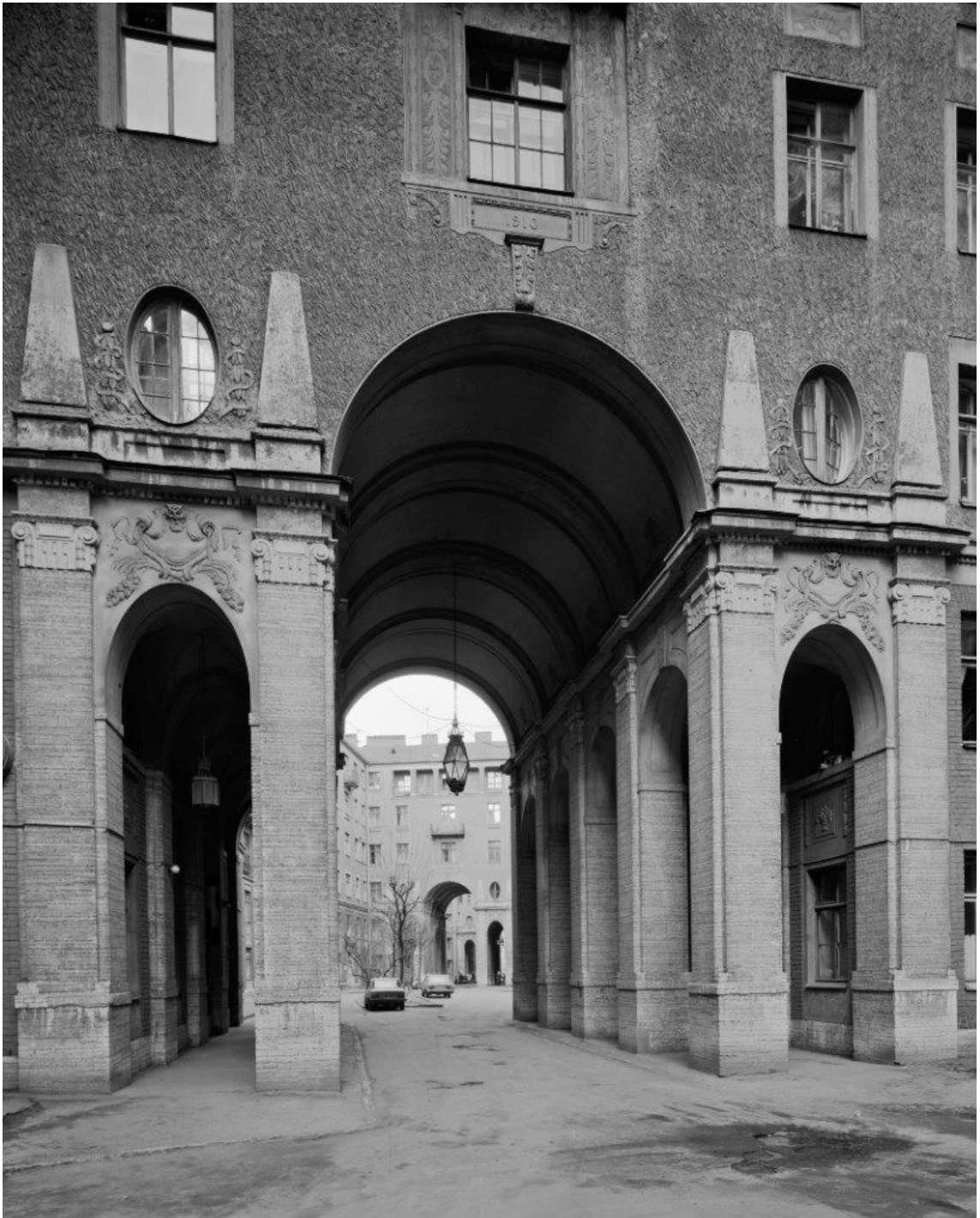
46. Толстовский дом. Вид на арочный проем со стороны ул. Рубинштейна, ведущий во двор. 1986 г. — «PastVu» – ретро-фотографии стран и городов [Электронный ресурс]. URL: https://pastvu.com .
