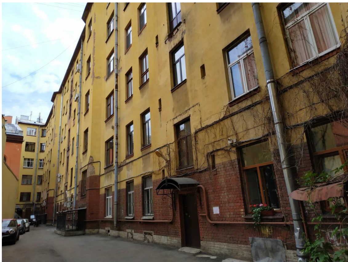
Фото 10. Северо-восточный дворовый фасад.
