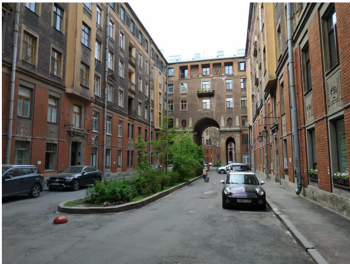
Фото 5. Общий вид дворовых фасадов здания со стороны ул. Рубинштейна
