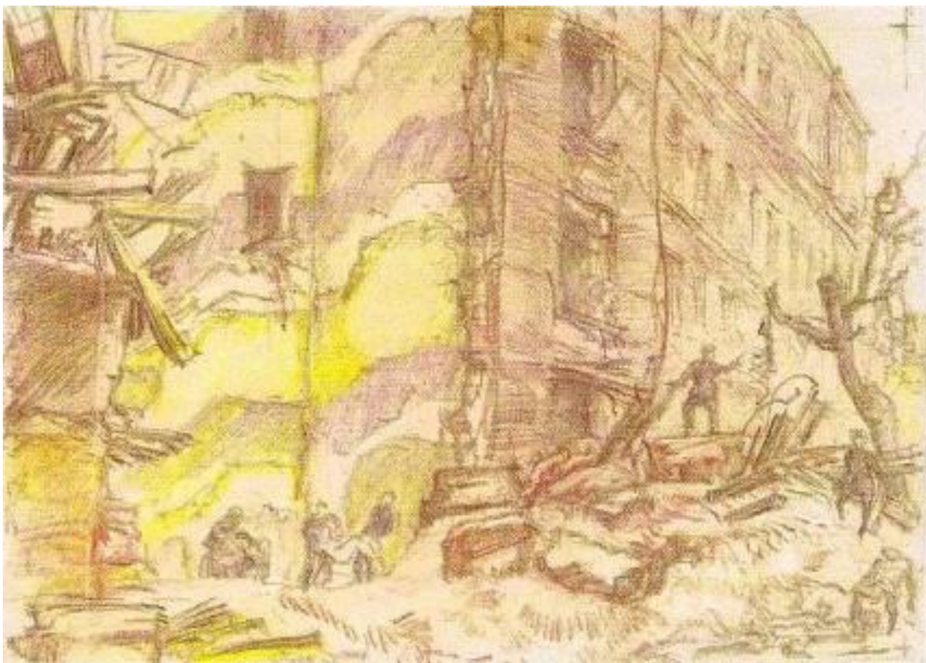
Илл. 6. Обрушения дома № 50 по набережной реки Фонтанки после попадания в угловую часть фугасной бомбы. Рисунок Н. Белехова //Сайт: oldsp.ru.
