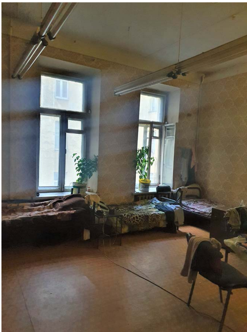
Фото 13. Выявленный объект культурного наследия «Дом М.С. Мальцева (Общества для заклада движимых имуществ)», по адресу: Санкт-Петербург, Литейный пр. д.29, Литер А (Литейный пр. 29). Квартира 33. Дата съемки: 01 сентября 2021 г.
