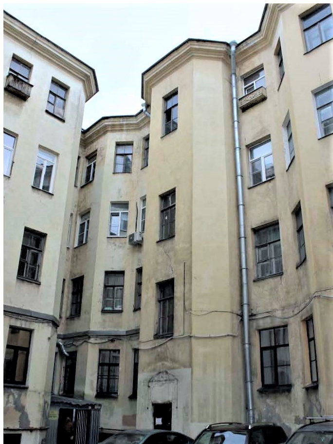
36. Объект культурного наследия регионального значения «Жилой дом Страхового общества «Россия» с садом и оградами», по адресу: г. Санкт-Петербург, Моховая улица, дом 27-29, литера А (Моховая ул., 27-29). Дворовый фасад. Дата съемки: 04.03.2022г.
