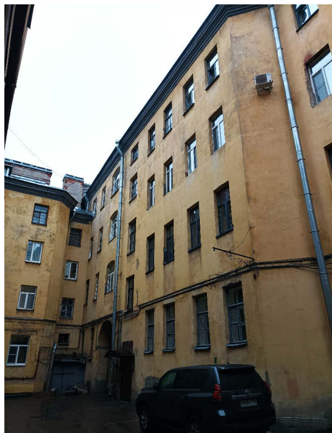
30. Объект культурного наследия регионального значения «Жилой дом Страхового общества «Россия» с садом и оградами», по адресу: г. Санкт-Петербург, Можовая улица, дом 27-29, литера А (Можовая ул., 27-29). Дворовый фасад. Дата съемки: 04.03.2022г.
