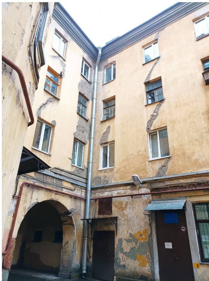
29. Объект культурного наследия регионального значения «Жилой дом Страхового общества «Россия» с садом и оградами», по адресу: г. Санкт-Петербург, Моховая улица, дом 27-29, литера А (Моховая ул., 27-29). Дворовый фасад. Дата съемки: 04.03.2022г.
