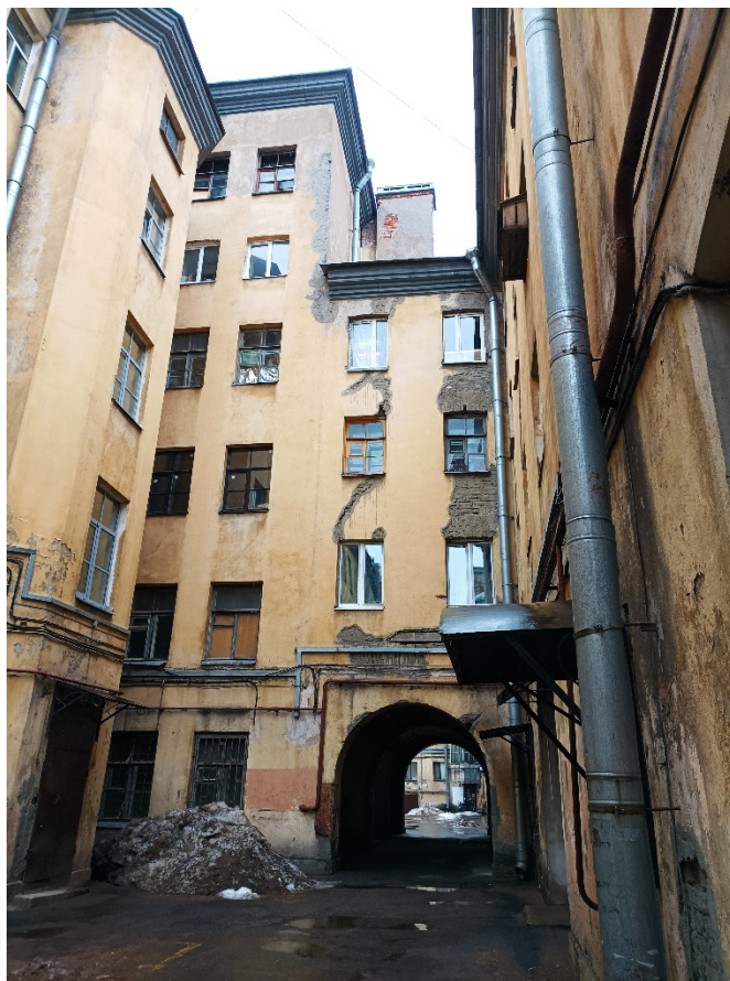
31. Объект культурного наследия регионального значения «Жилой дом Страхового общества «Россия» с садом и оградами», по адресу: г. Санкт-Петербург, Моховая улица, дом 27-29, литера А (Моховая ул., 27-29). Дворовый фасад. Дата съемки: 04.03.2022г.
