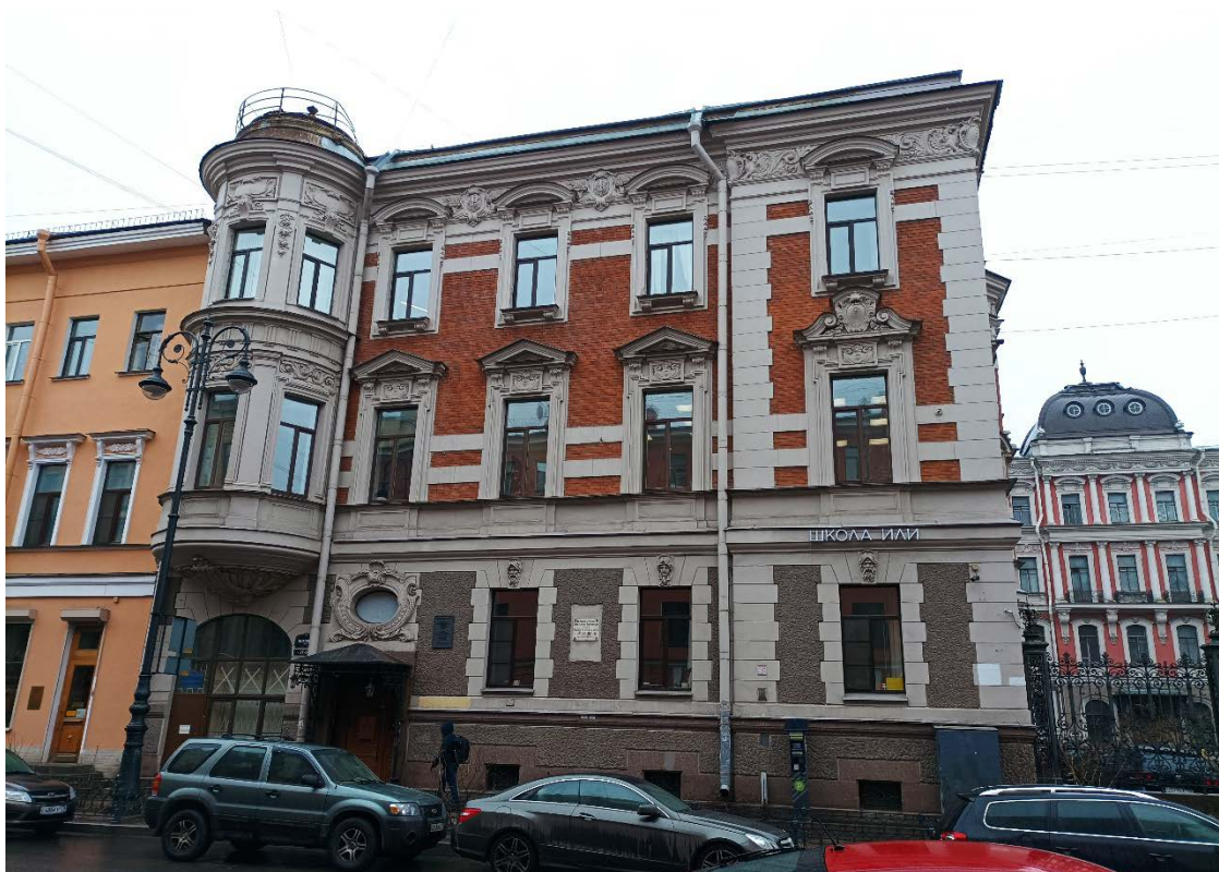
3. Объект культурного наследия регионального значения «Жилой дом Страхового общества «Россия» с садом и оградами», по адресу: г. Санкт-Петербург, Моховая улица, дом 27-29, литера А (Моховая ул., 27-29). Лицевой фасад «Главное здание с флигелями». Дата съемки: 04.03.2022г.
