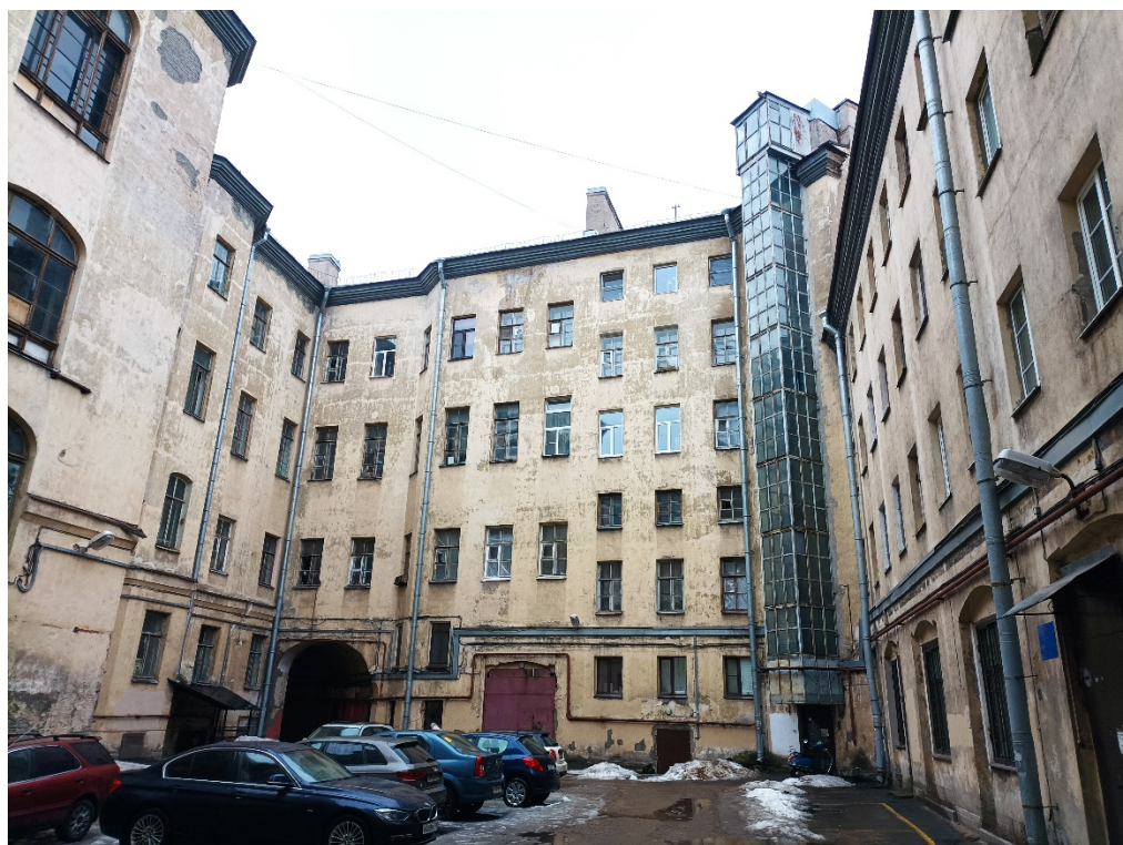
26. Объект культурного наследия регионального значения «Жилой дом Страхового общества «Россия» с садом и оградами», по адресу: г. Санкт-Петербург, Моховая улица, дом 27-29, литера А (Моховая ул., 27-29). Дворовый фасад. Дата съемки: 04.03.2022г.
