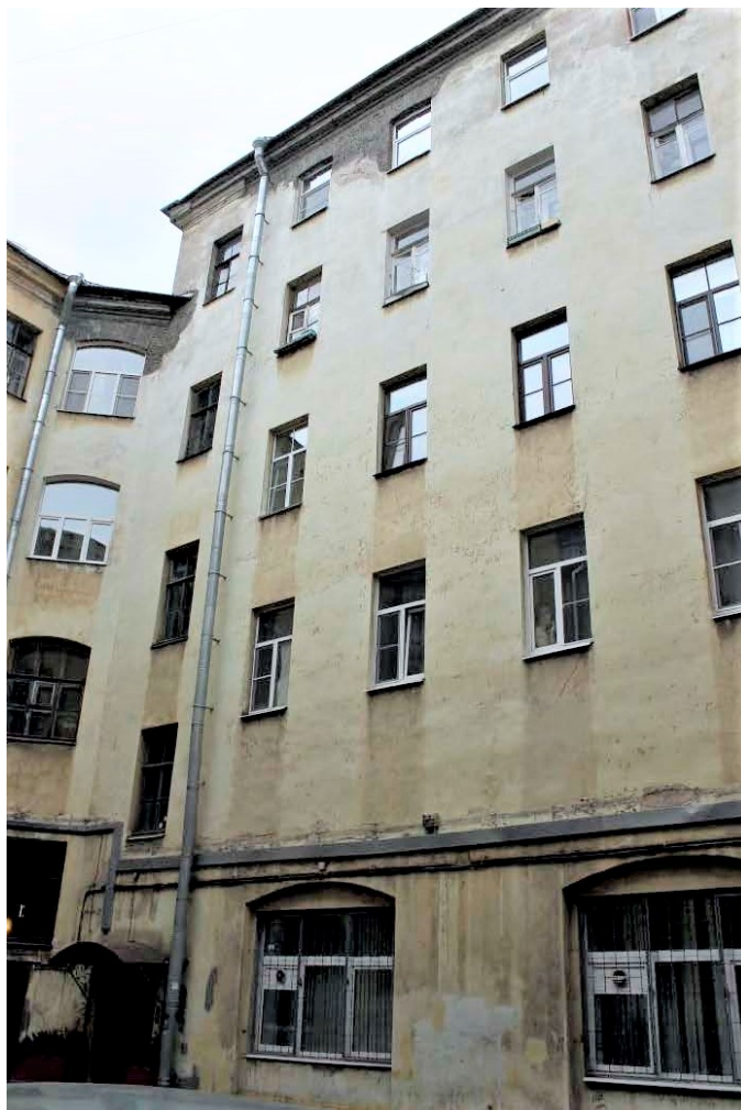
34. Объект культурного наследия регионального значения «Жилой дом Страхового общества «Россия» с садом и оградами», по адресу: г. Санкт-Петербург, Моховая улица, дом 27-29, литера А (Моховая ул., 27-29). Дворовый фасад. Дата съемки: 04.03.2022г.
