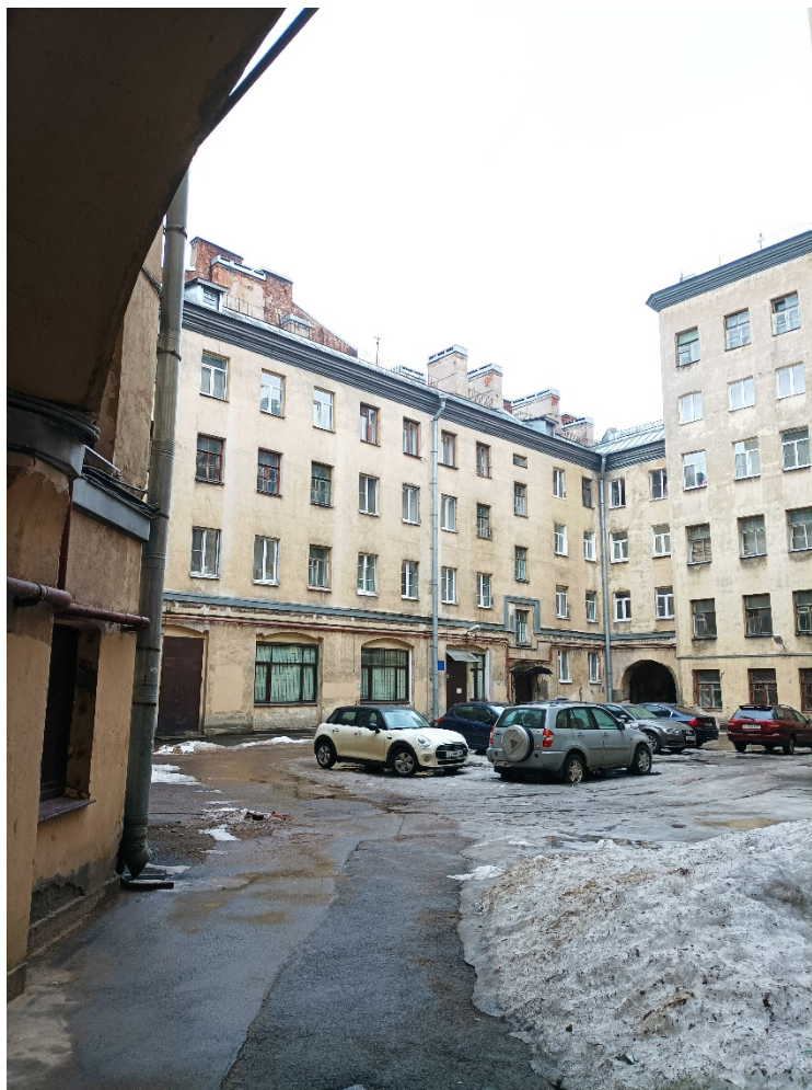
20. Объект культурного наследия регионального значения «Жилой дом Страхового общества «Россия» с садом и оградами», по адресу: г. Санкт-Петербург, Моховая улица, дом 27-29, литера А (Моховая ул., 27-29). Дворовый фасад. Дата съемки: 04.03.2022г.
