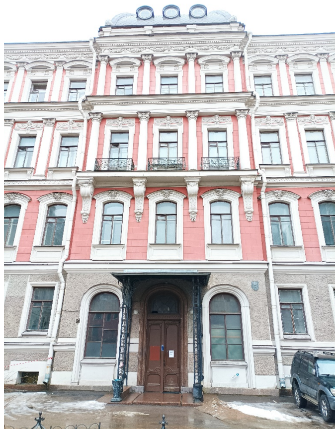
8. Объект культурного наследия регионального значения «Жилой дом Страхового общества «Россия» с садом и оградами», по адресу: г. Санкт-Петербург, Моховая улица, дом 27-29, литера А (Моховая ул., 27-29). Фрагмент фасада «Главное здание с флигелями». Дата съемки: 04.03.2022г.
