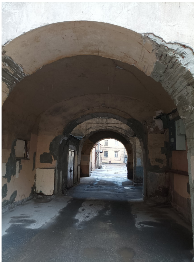
27. Объект культурного наследия регионального значения «Жилой дом Страхового общества «Россия» с садом и оградами», по адресу: г. Санкт-Петербург, Моховая улица, дом 27-29, литера А (Моховая ул., 27-29). Дворовый фасад. Арка. Дата съемки: 04.03.2022г.
