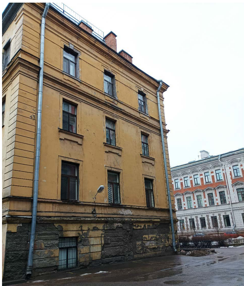
12. Объект культурного наследия регионального значения «Жилой дом Страхового общества «Россия» с садом и оградами», по адресу: г. Санкт-Петербург, Моховая улица, дом 27-29, литера А (Моховая ул., 27-29). Дворовый фасад «Северный корпус». Дата съемки: 04.03.2022г.
