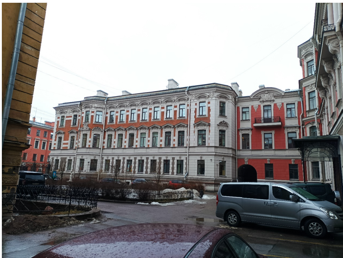
5. Объект культурного наследия регионального значения «Жилой дом Страхового общества «Россия» с садом и оградами», по адресу: г. Санкт-Петербург, Моховая улица, дом 27-29, литера А (Моховая ул., 27-29). Лицевой фасад «Главное здание с флигелями». Дата съемки: 04.03.2022г.
