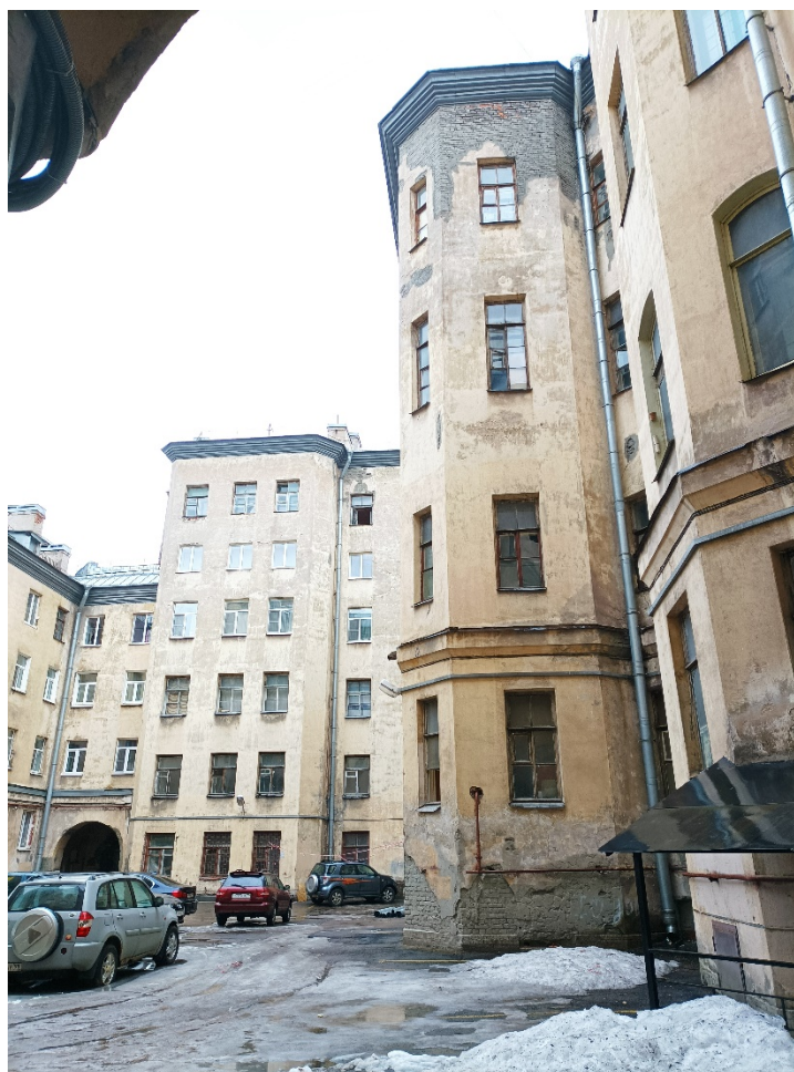
22. Объект культурного наследия регионального значения «Жилой дом Страхового общества «Россия» с садом и оградами», по адресу: г. Санкт-Петербург, Моховая улица, дом 27-29, литера А (Моховая ул., 27-29). Дворовый фасад. Дата съемки: 04.03.2022г.
