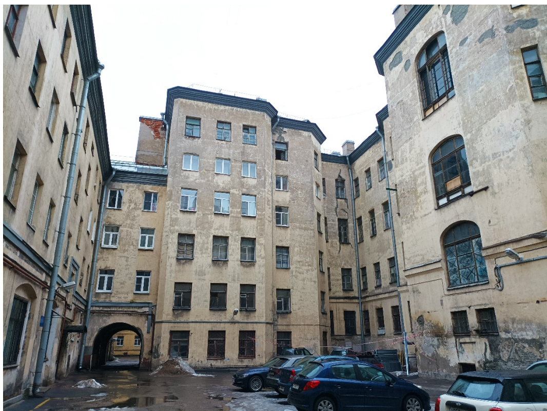
25. Объект культурного наследия регионального значения «Жилой дом Страхового общества «Россия» с садом и оградами», по адресу: г. Санкт-Петербург, Моховая улица, дом 27-29, литера А (Моховая ул., 27-29). Дворовый фасад. Дата съемки: 04.03.2022г.
