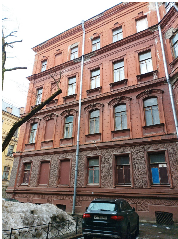
19. Объект культурного наследия регионального значения «Жилой дом Страхового общества «Россия» с садом и оградами», по адресу: г. Санкт-Петербург, Можовая улица, дом 27-29, литера А (Можовая ул., 27-29). Дворовый фасад «Главное здание с флигелями». Дата съемки: 04.03.2022г.
