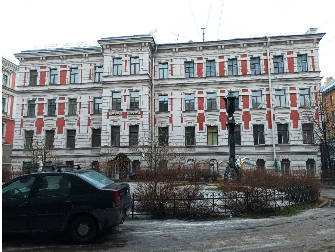
9. Объект культурного наследия регионального значения «Жилой дом Страхового общества «Россия» с садом и оградами», по адресу: г. Санкт-Петербург, Моховая улица, дом 27-29, литера А (Моховая ул., 27-29). Лицевой фасад «Северный корпус». Дата съемки: 04.03.2022г.
