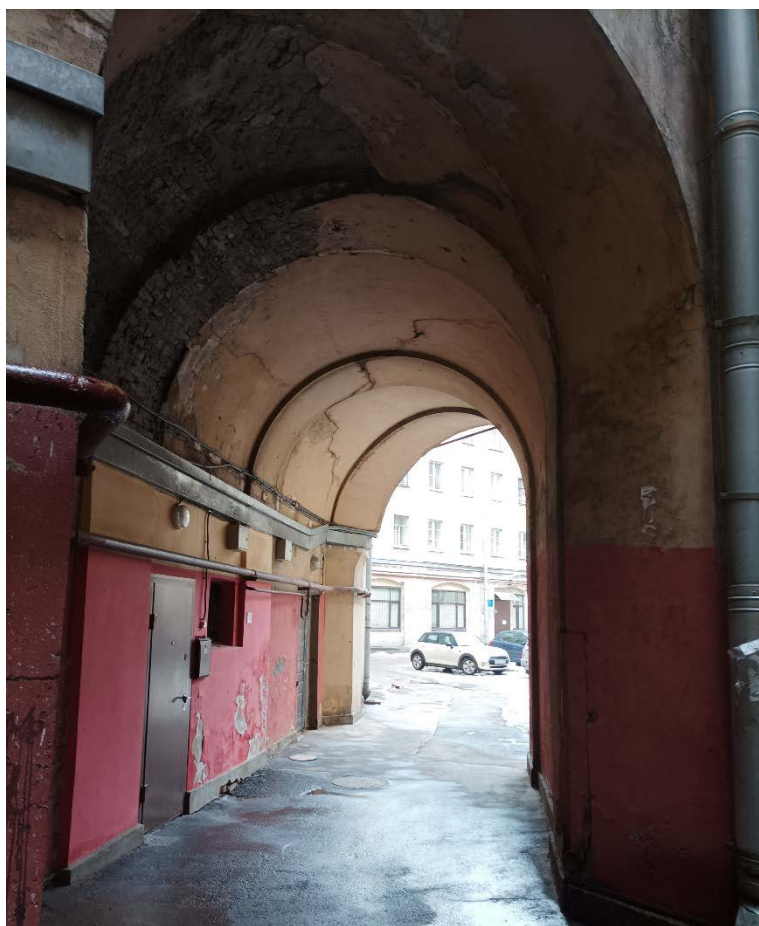
21. Объект культурного наследия регионального значения «Жилой дом Страхового общества «Россия» с садом и оградами», по адресу: г. Санкт-Петербург, Моховая улица, дом 27-29, литера А (Моховая ул., 27-29). Дворовый фасад. Арка. Дата съемки: 04.03.2022г.
