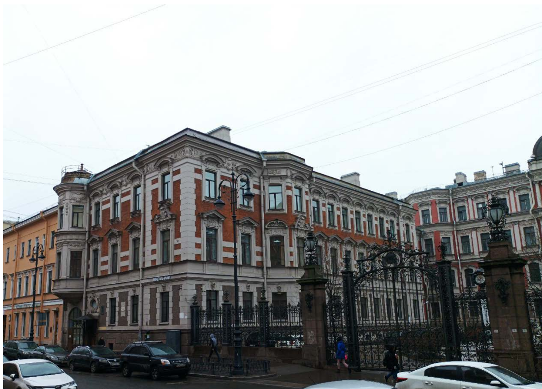
4. Объект культурного наследия регионального значения «Жилой дом Страхового общества «Россия» с садом и оградами», по адресу: г. Санкт-Петербург, Можовая улица, дом 27-29, литера А (Можовая ул., 27-29). Лицевой фасад «Главное здание с флигелями». Дата съемки: 04.03.2022г.
