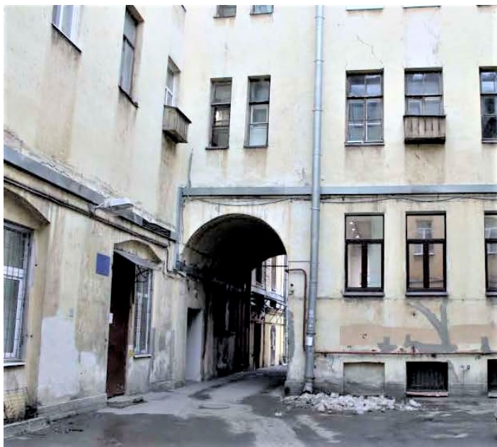
33. Объект культурного наследия регионального значения «Жилой дом Страхового общества «Россия» с садом и оградами», по адресу: г. Санкт-Петербург, Моховая улица, дом 27-29, литера А (Моховая ул., 27-29). Дворовый фасад. Дата съемки: 04.03.2022г.
