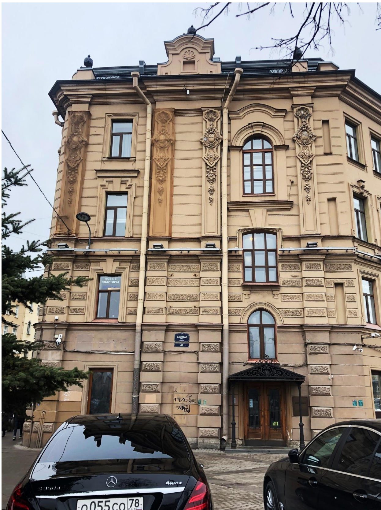
Фото 5. Западный фрагмент юго-западного лицевого фасада, расположенный на углу с ул. Садовой.
