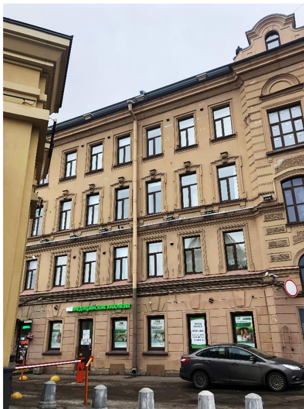
Фото 9. Южный фрагмент юго-западного лицевого фасада.
