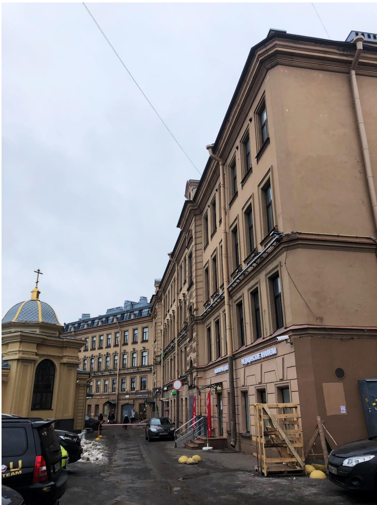
Фото 11. Вид на юго-западный лицевой фасад с юго-востока.
