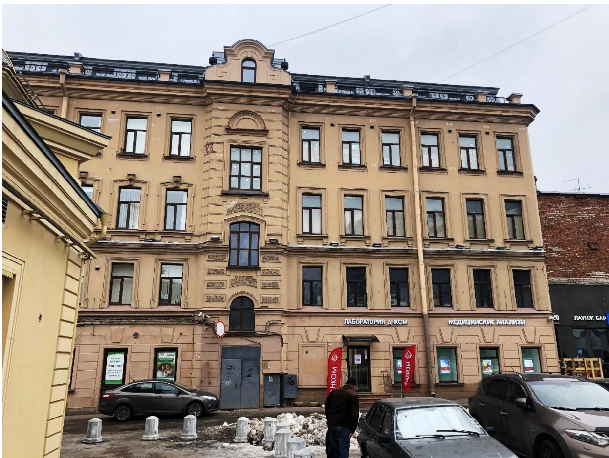
Фото 8. Южный фрагмент юго-западного лицевого фасада.
