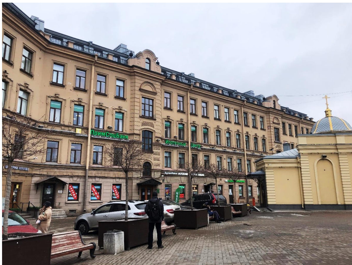
Фото 7. Южный фрагмент юго-западного лицевого фасада.
