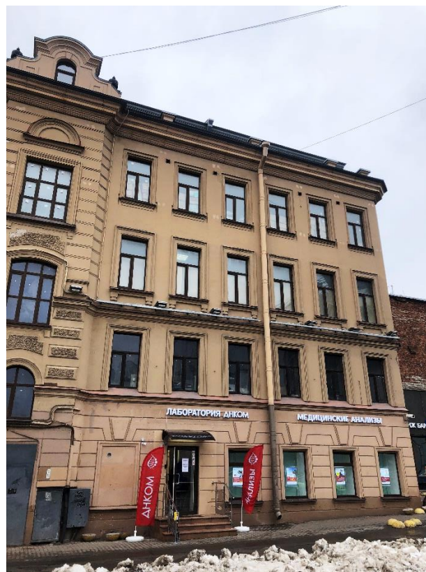
Фото 10. Южный фрагмент юго-западного лицевого фасада.
