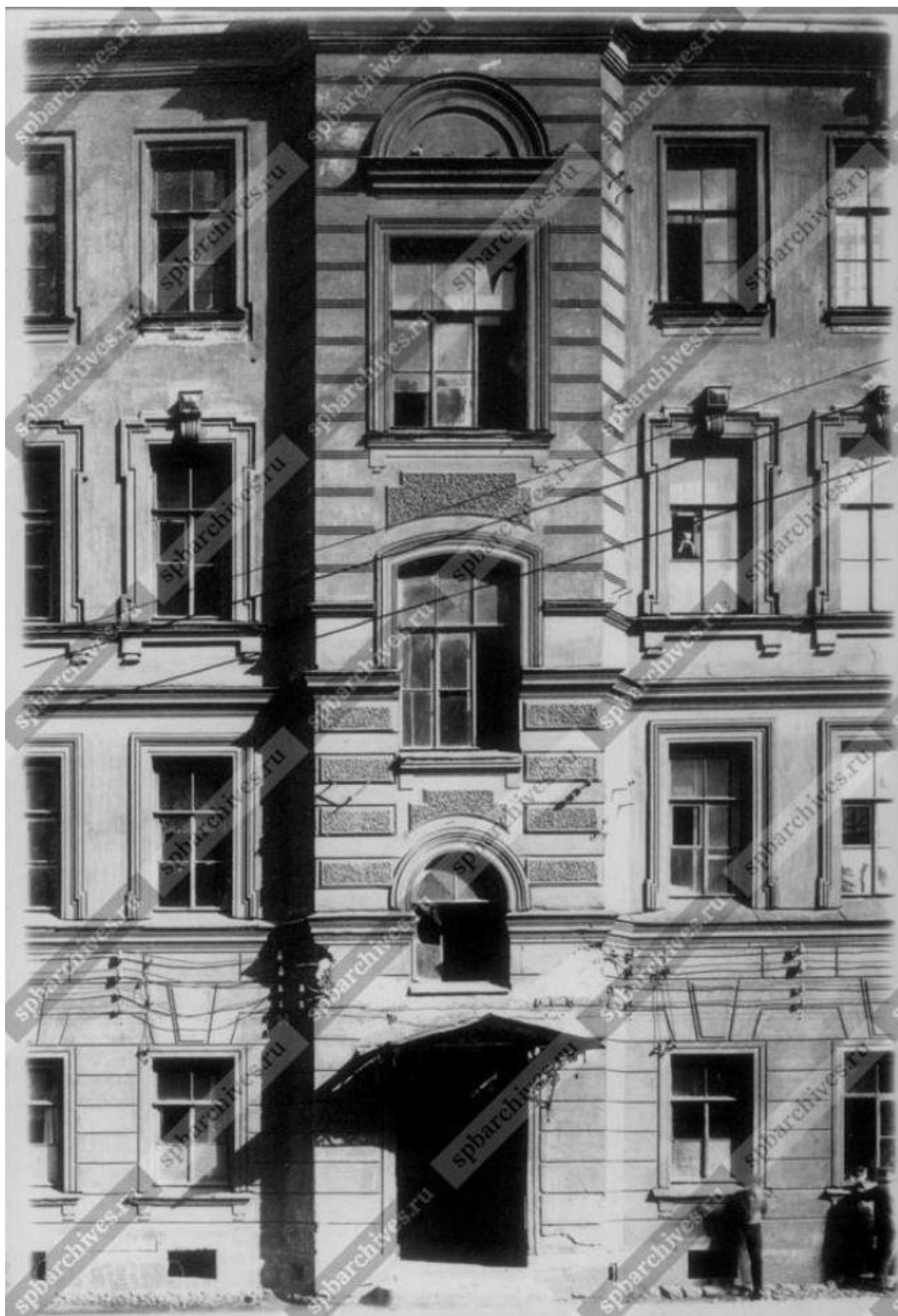
49. Вид части юго-восточного фасада дома № 40 со стороны Сенной площади. 1939 г. ЦГАКФФД Гр 77810
