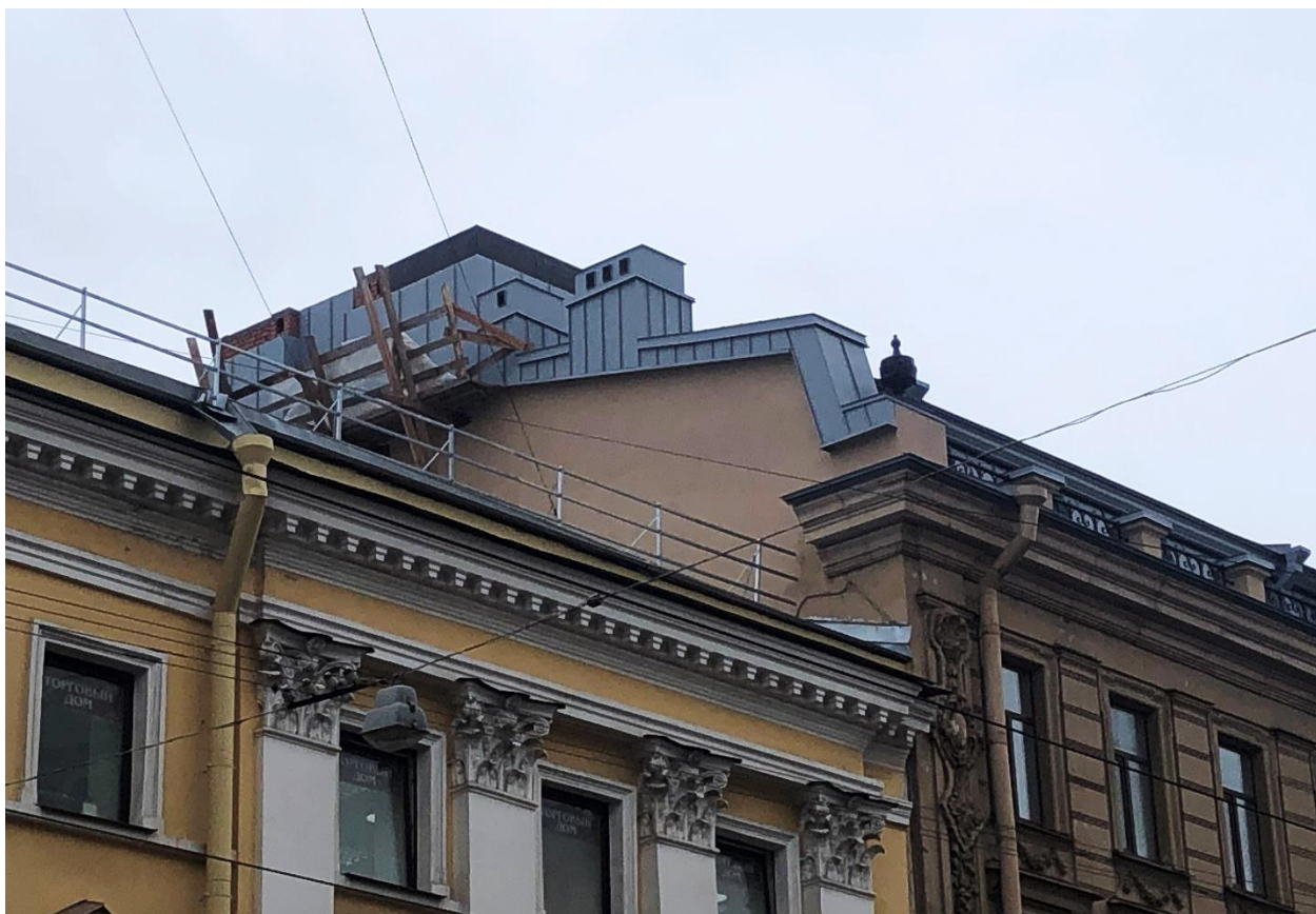
Фото 14. Вид на северо-восточную торцевую (брандмауэрную) стену.
