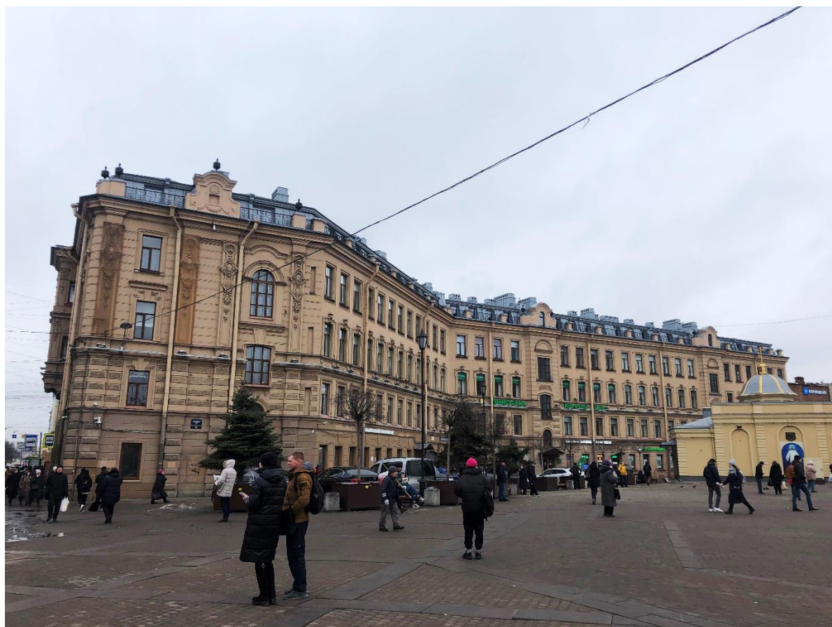
Фото 4. Вид на юго-западный лицевой фасад, выходящий на Сенную площадь.
