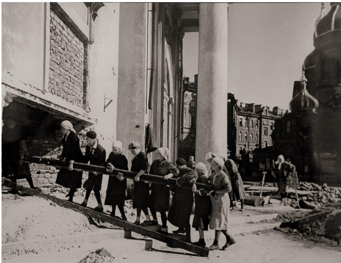
54. Ремонтно-восстановительные работы на Сенной площади. 1943 г. Источник: https://pastvu.com/p/298408
