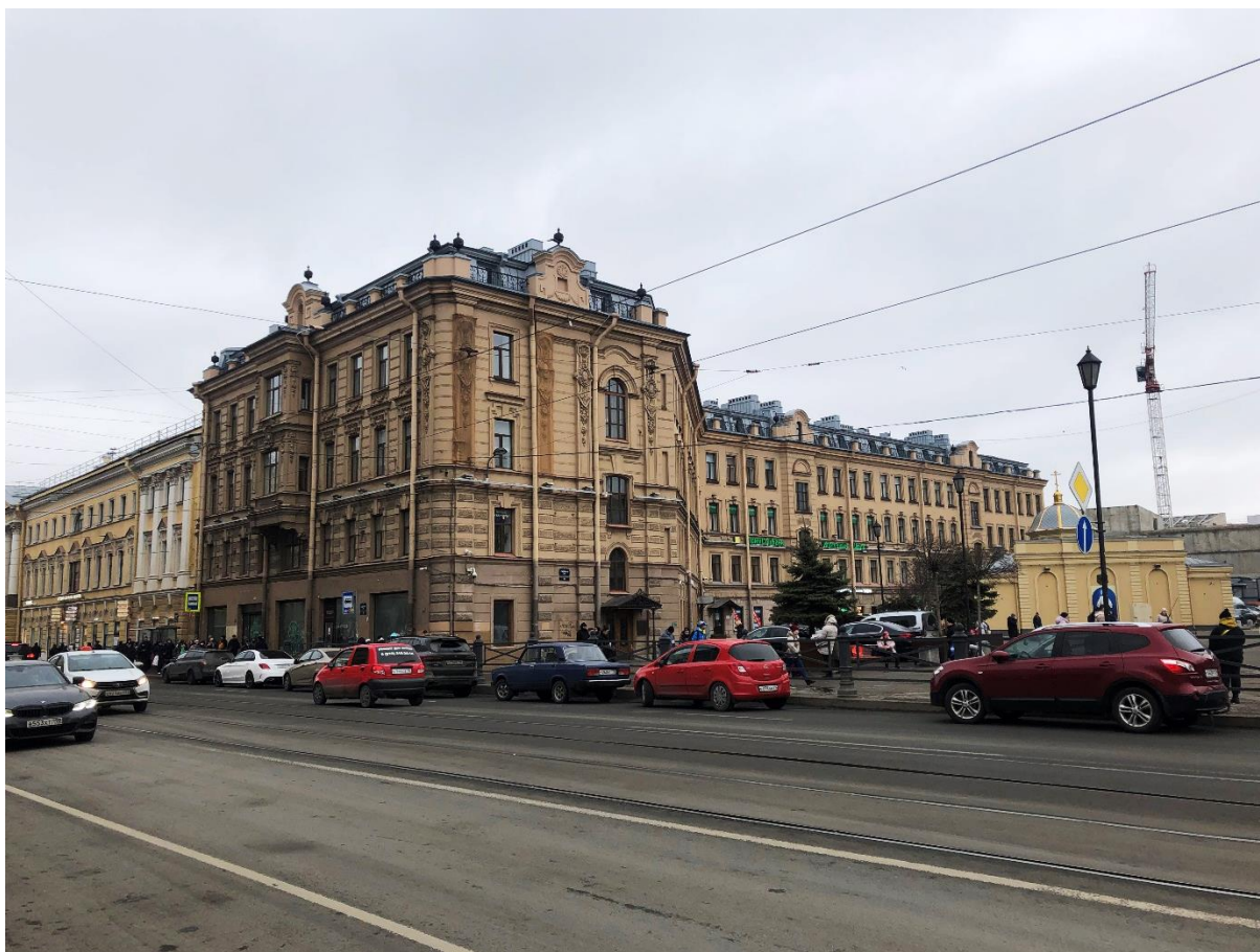
Фото 3. Вид на угол лицевых фасадов по Сенной пл. и ул. Садовой.
