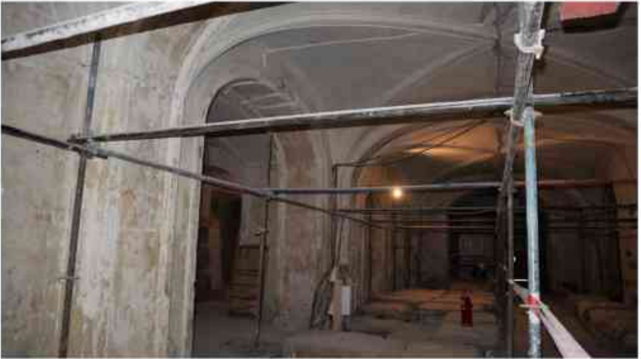
Фото 1.254. 1 этаж, помещение 13Н (10).
