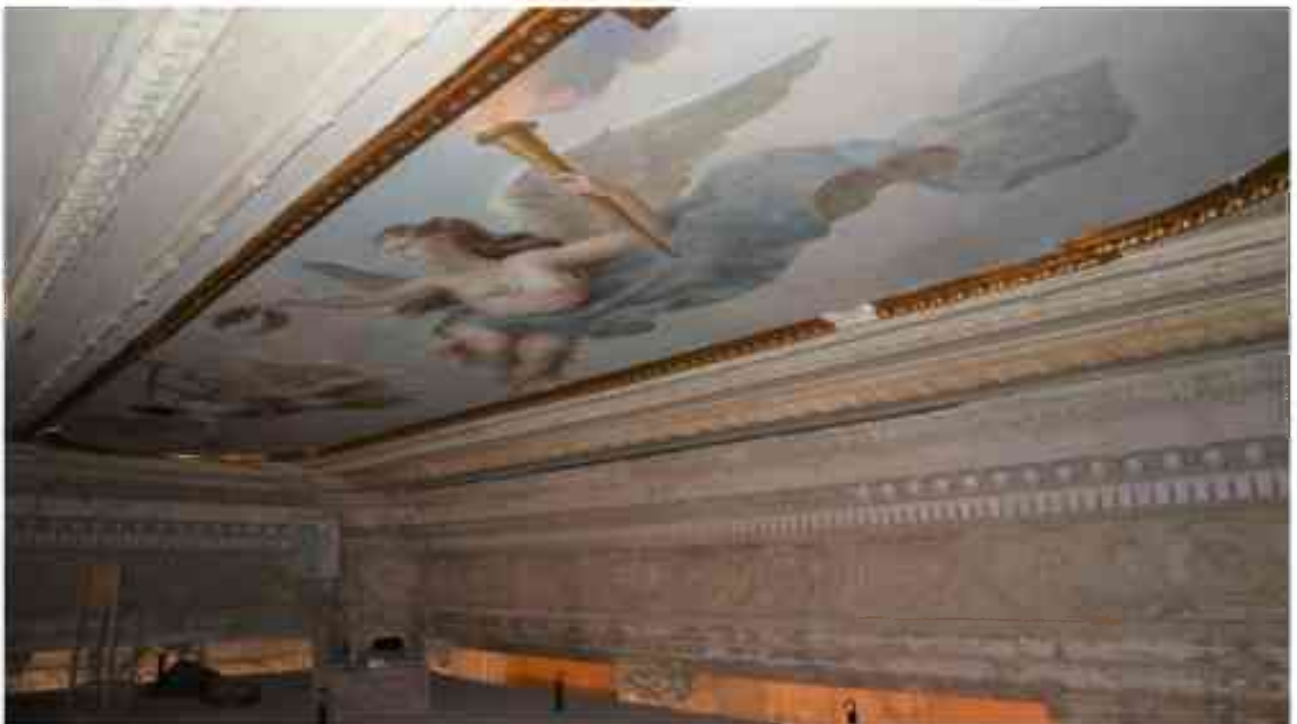
Фото 3.84. 3 этаж, помещение 28Н (2).*
