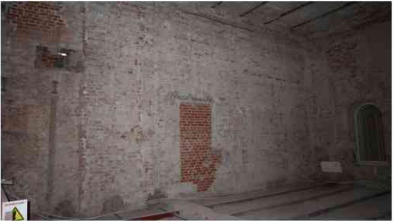
Фото 4.123. 4 этаж, помещение 29Н (5, 10-11).
