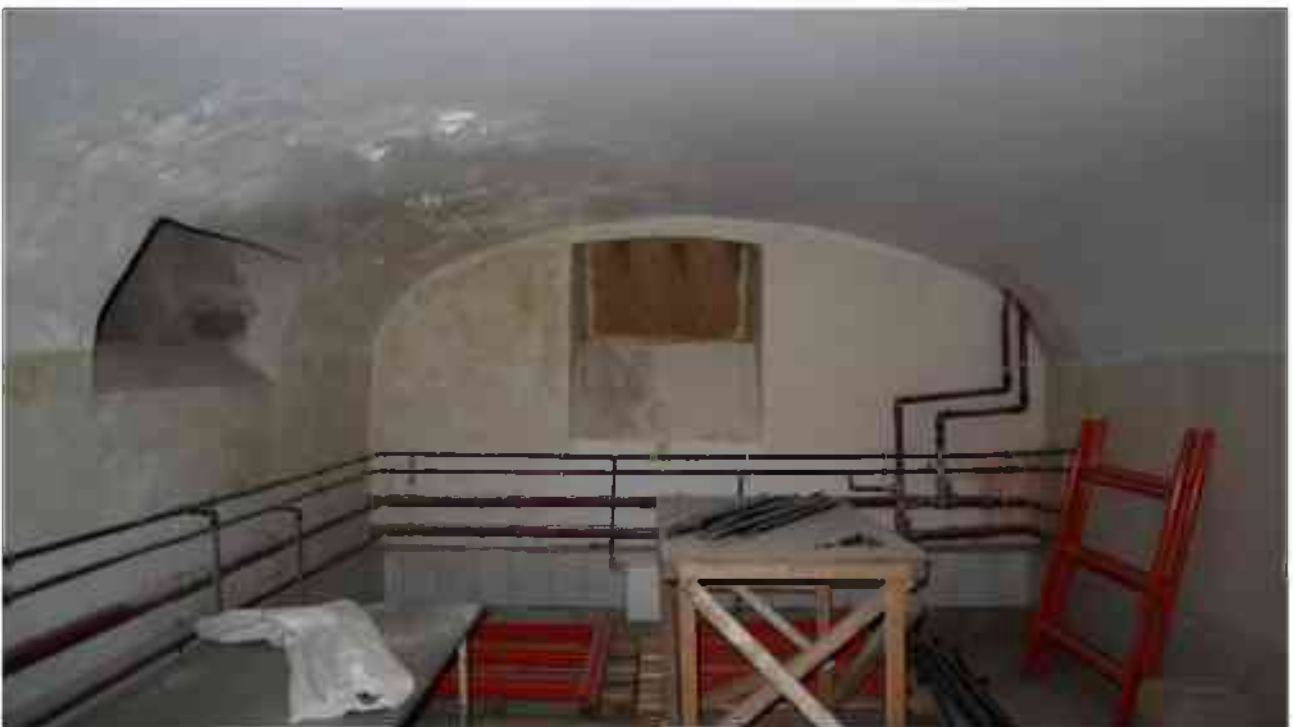
Фото п.130. Подвал, помещение 4Н (14-16).
