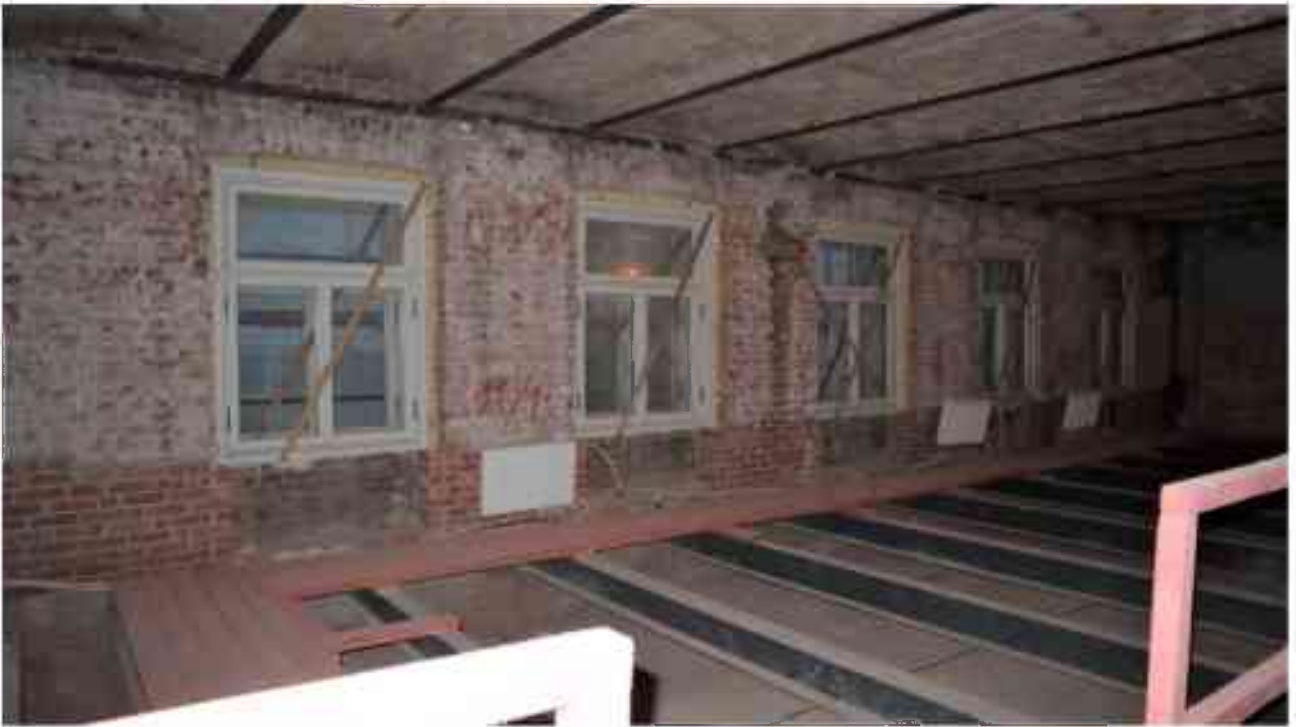
Фото 4.99. 4 этаж, помещение 36Н (1-3, 7-9).
