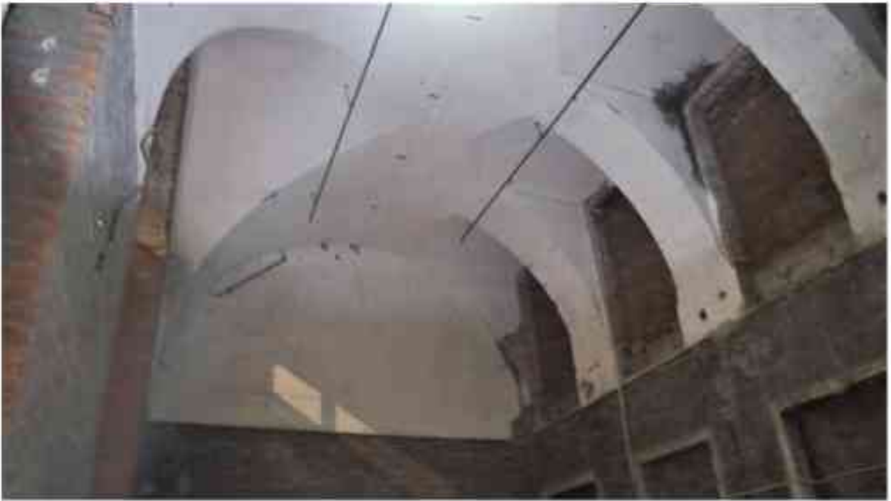
Фото 2.214. 2 этаж, помещение 22Н (83).
