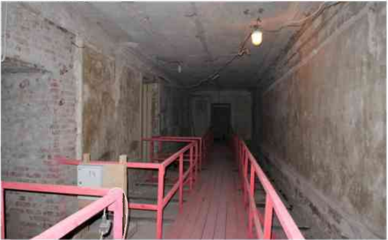
Фото 3.128. 3 этаж, помещение 25Н (5).
