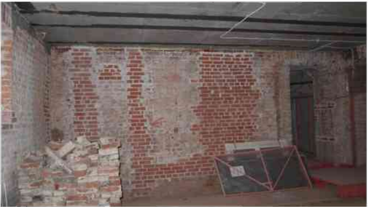
Фото 5.26. 5 этаж, помещение 37Н (9), 35Н (19).
