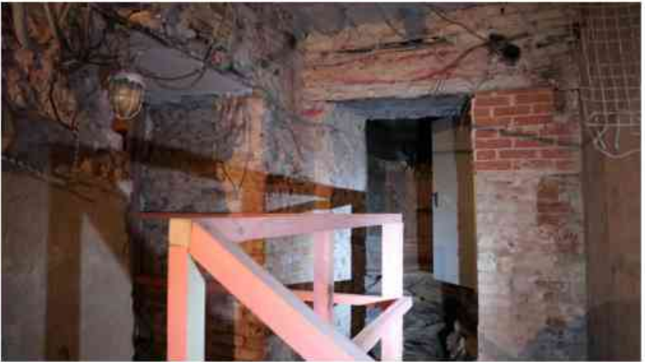
Фото п.75. Подвал, помещение 3Н (2).
