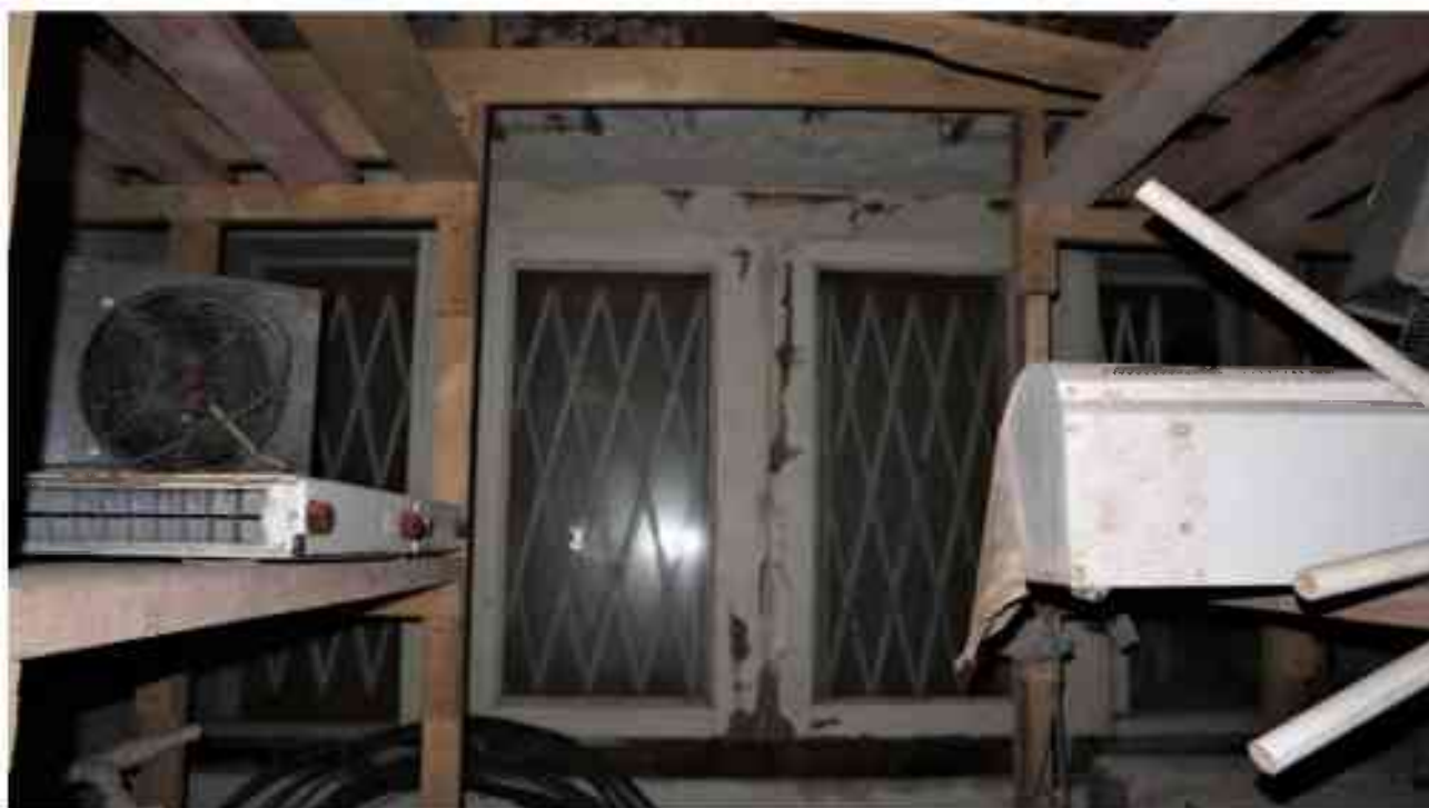
Фото 1.234. 1 этаж, помещение 15Н (3).
