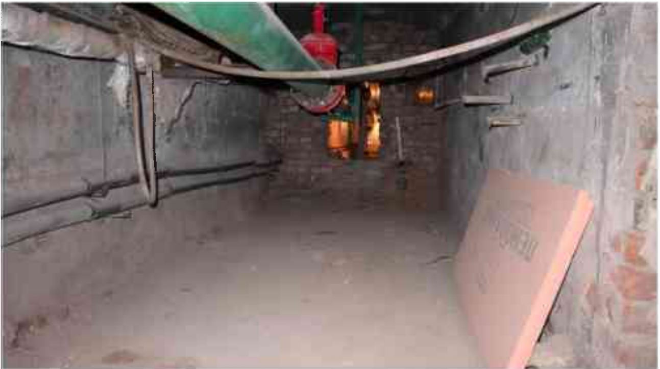
Фото п.298. Подвал, помещение 6Н (8).
