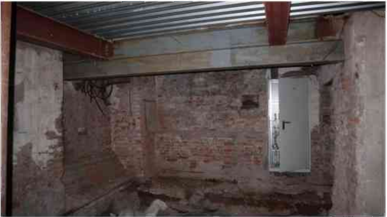
Фото п.28. Подвал, помещение 3Н (6).
