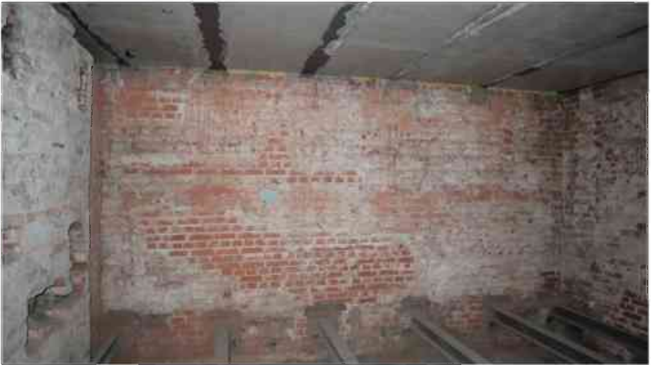
Фото 5.154. 5 этаж, жилой блок, на плане ПИБ 2000г. обозначен как квартиры, помещение (1-2).
