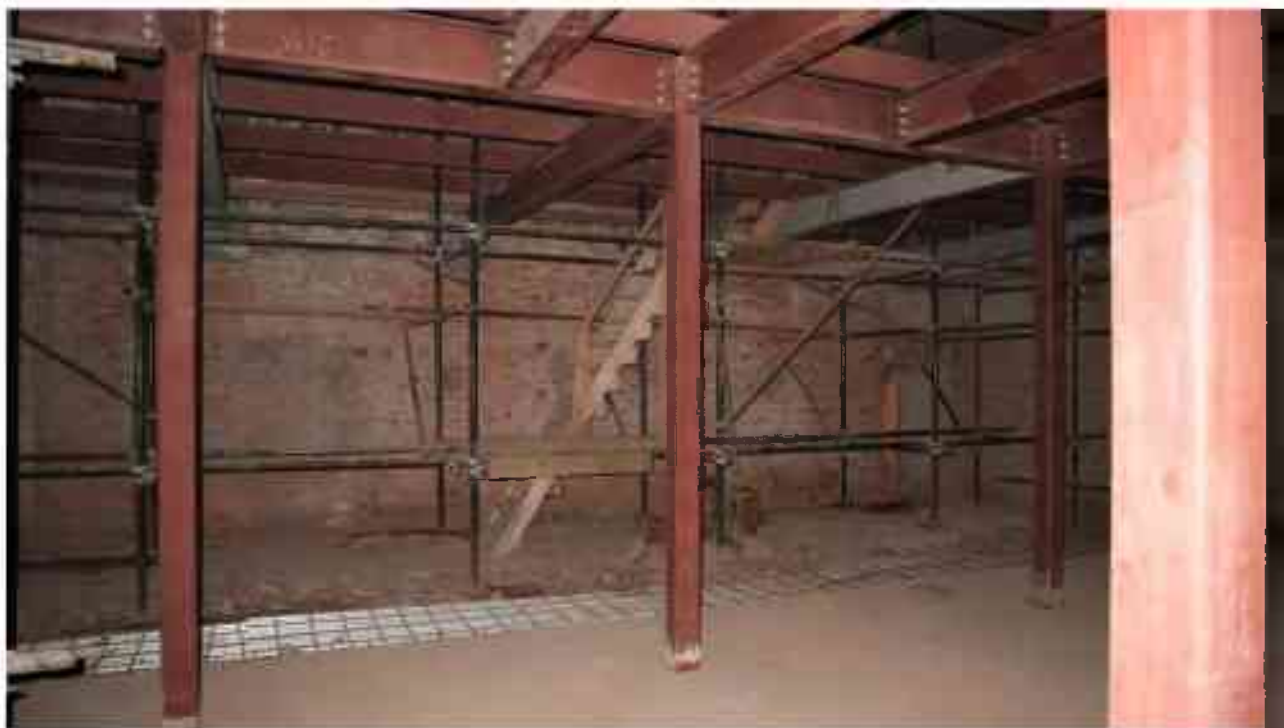
Фото 1.189. 1 этаж, помещение 17Н (3).
