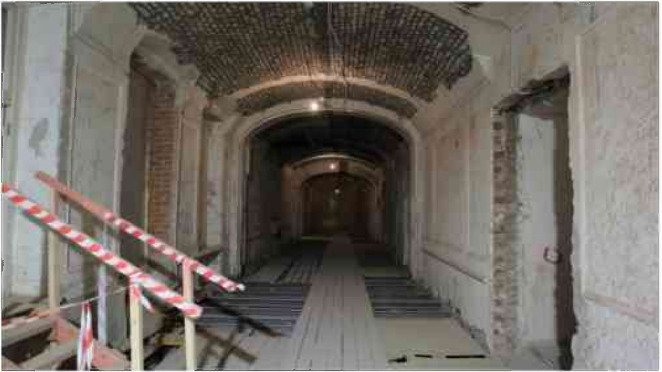
Фото 2.15. 2 этаж, помещение 22Н (64-67).
