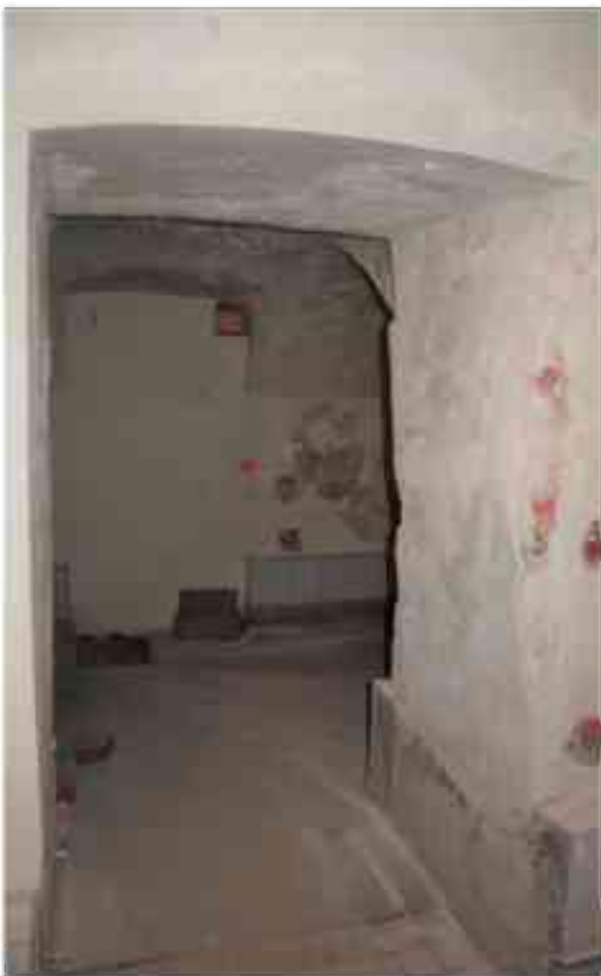
Фото п.153. Подвал, помещение 9Н (16-17).
