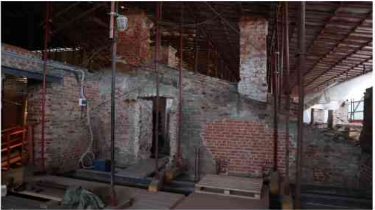
Фото 5.192. 5 этаж, чердачное помещение.
