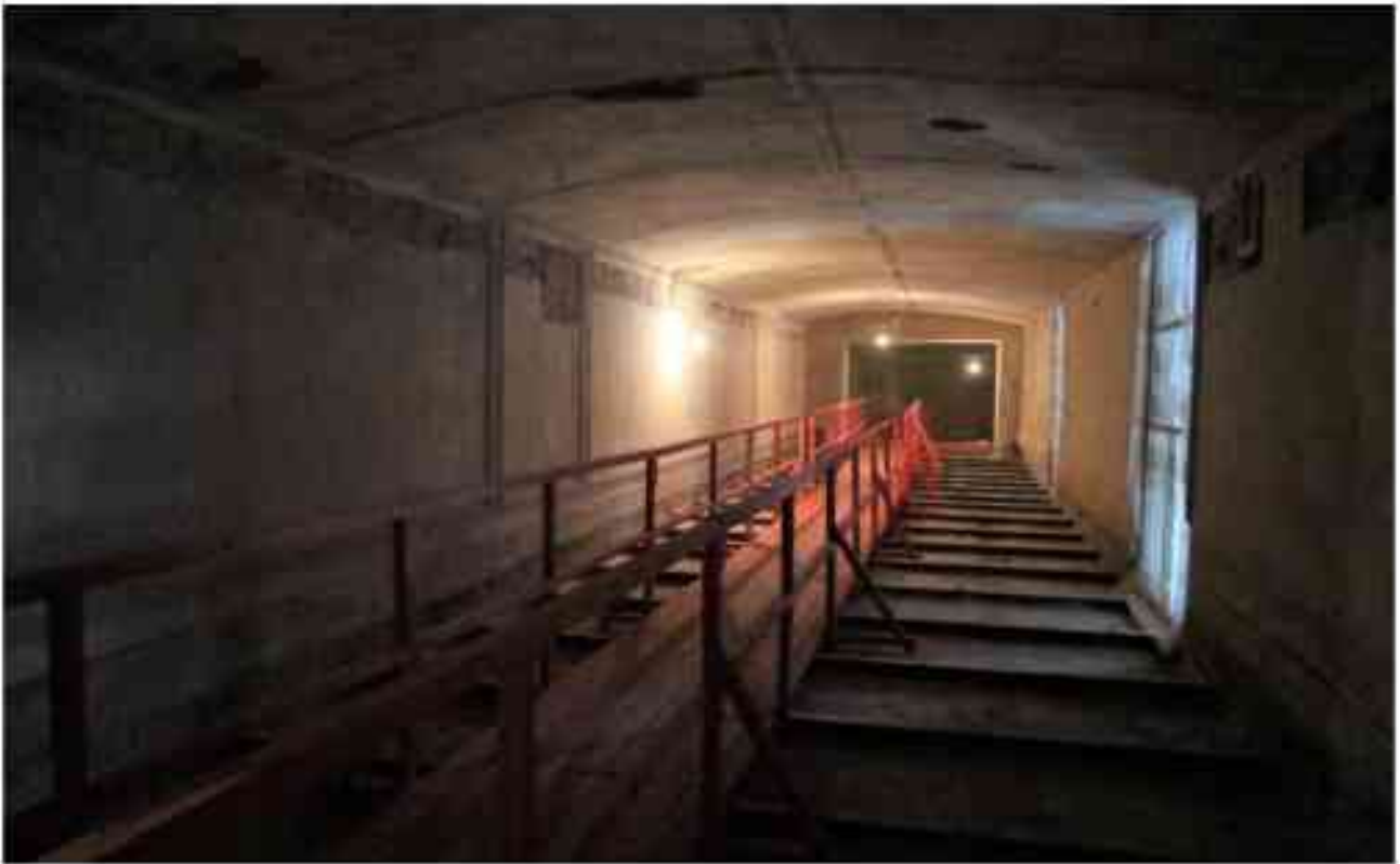
Фото 3.115. 3 этаж, помещение 25Н (2).
