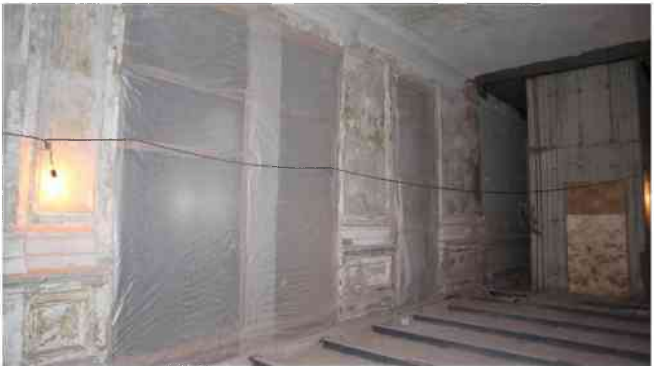
Фото 2.169. 2 этаж, помещение 22Н (17).
