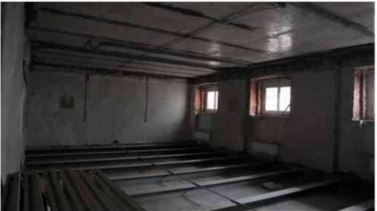
Фото 5.15. 5 этаж, помещение 37Н (2-5).
