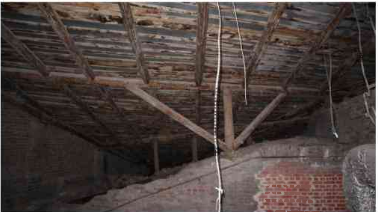
Фото 6.63. 6 этаж, чердачное помещение.
