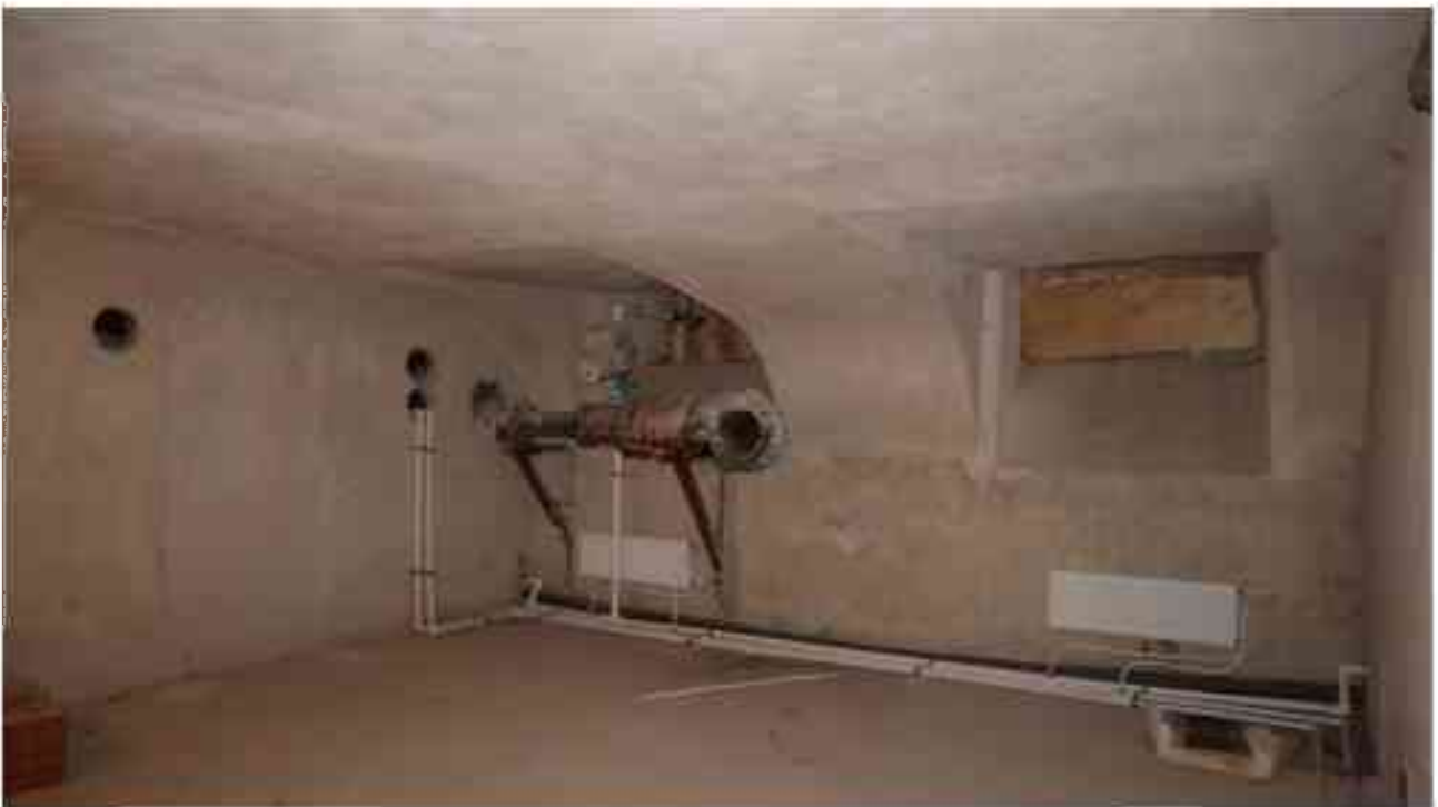
Фото п.12. Подвал, помещение 2Н (3).
