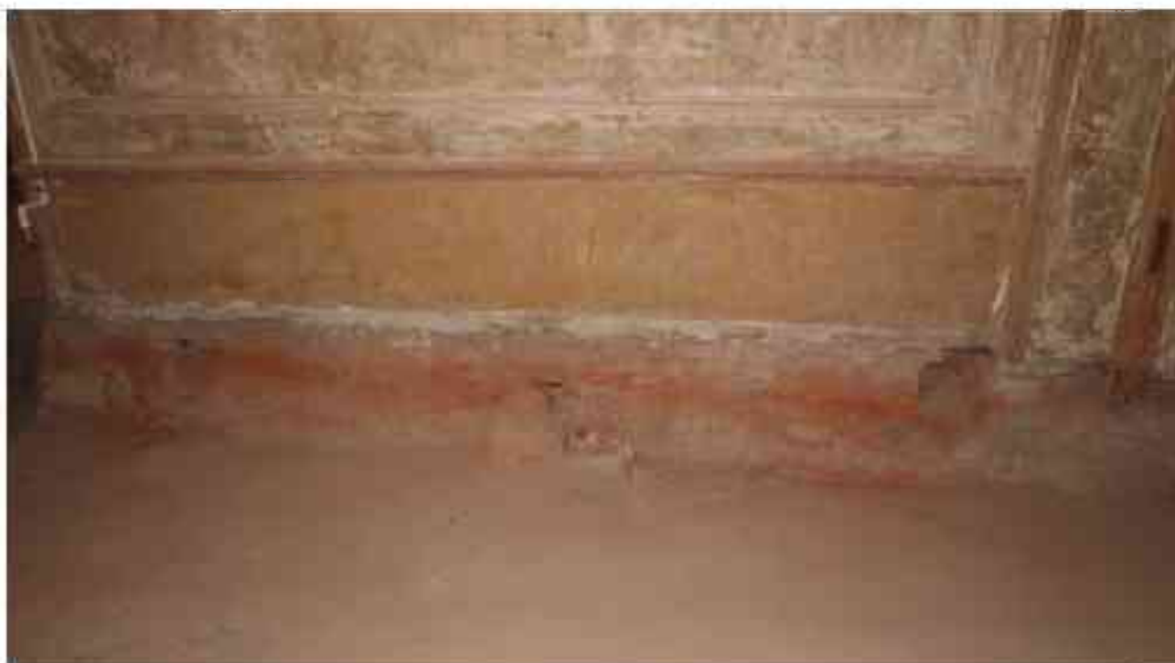
Фото 4.34. 4 этаж, помещение 33Н (30).
