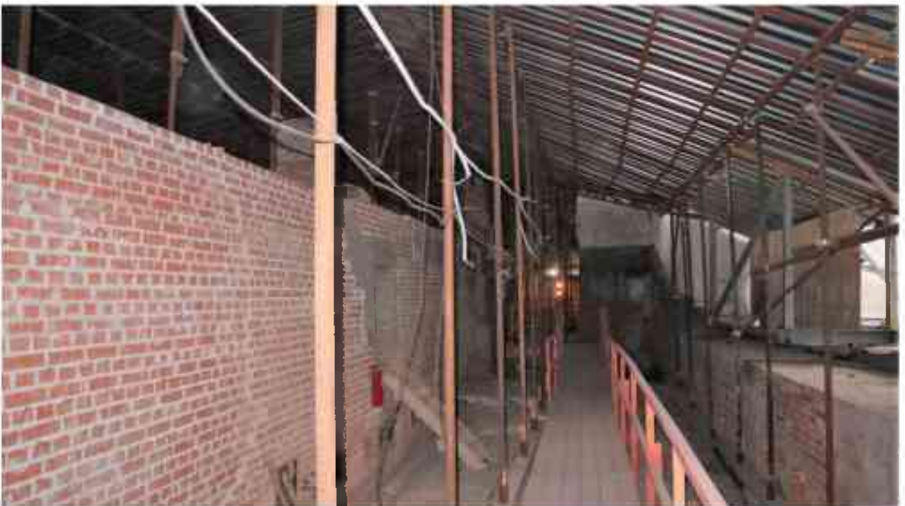
Фото 5.127. 5 этаж, коридор, помещения 34Н/37Н.
