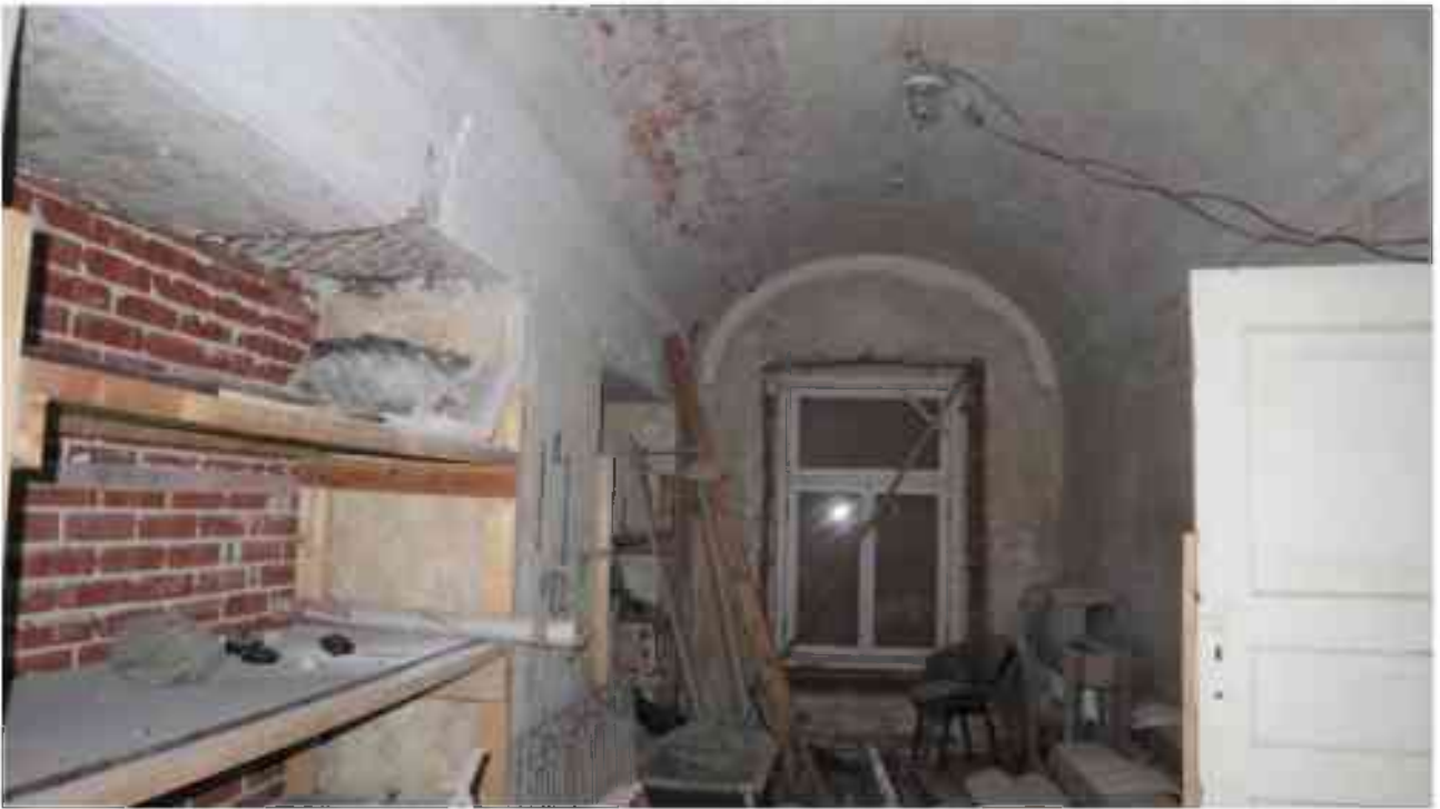
Фото 1.68. 1 этаж, помещение 14Н (23).
