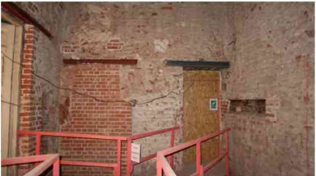
Фото 5.62. 5 этаж, помещение 35Н (4-6).
