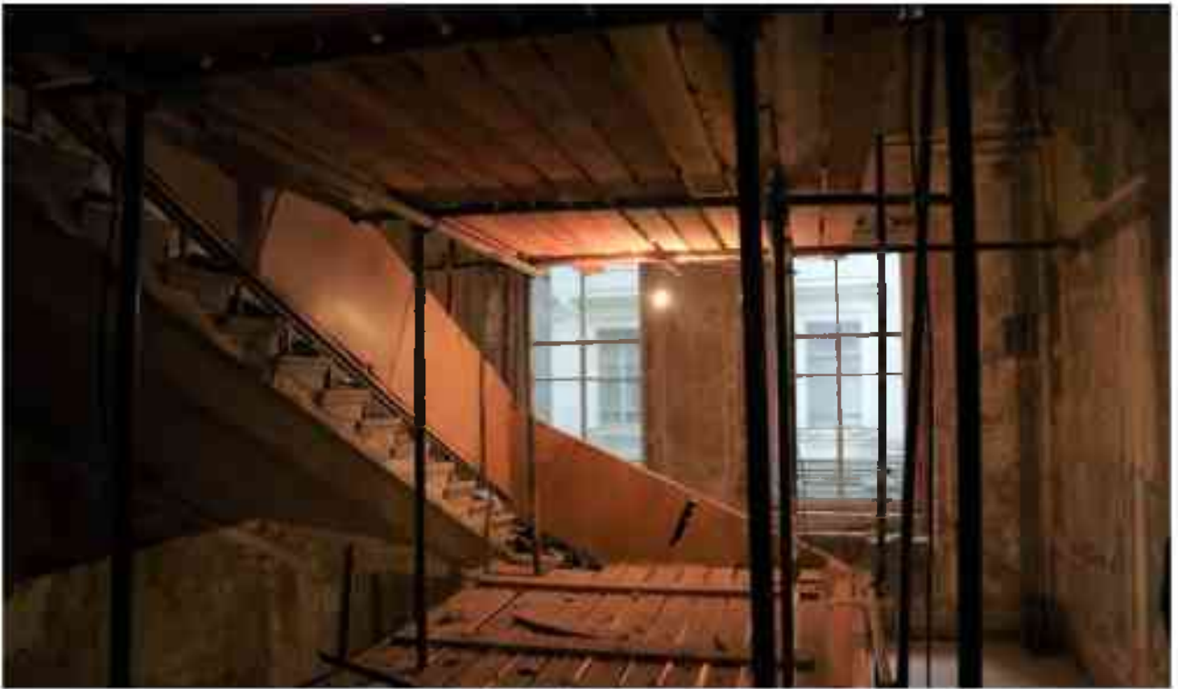
Фото 3.126. 3 этаж, лестница Л-13.
