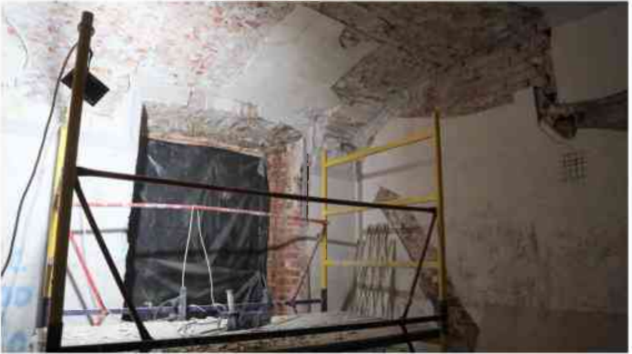
Фото 1.102. 1 этаж, помещение 14Н (29).
