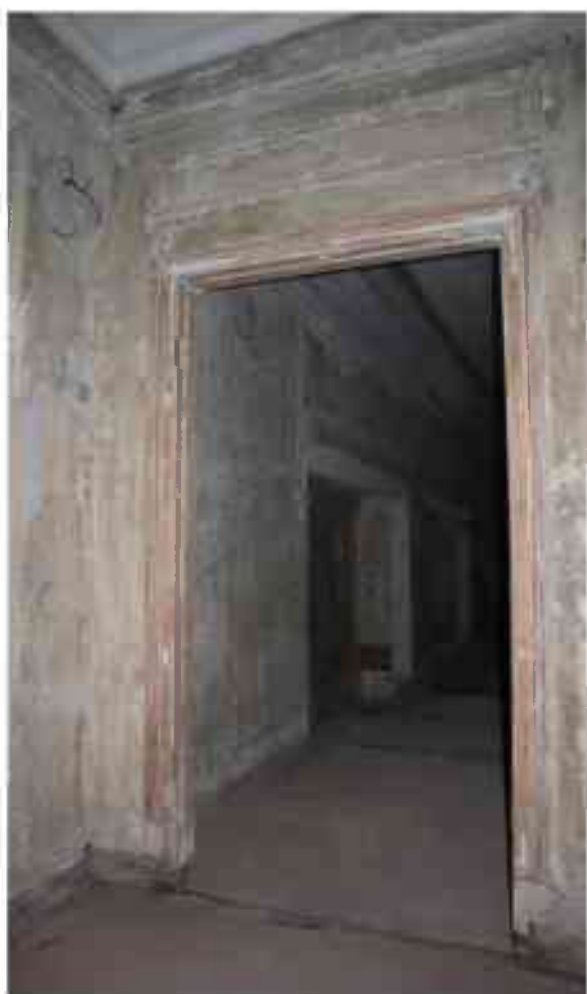
Фото 4.9. 4 этаж, помещение 33Н (39).
