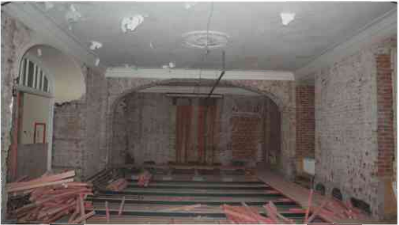
Фото 2.25. 2 этаж, помещение 22Н (48).
