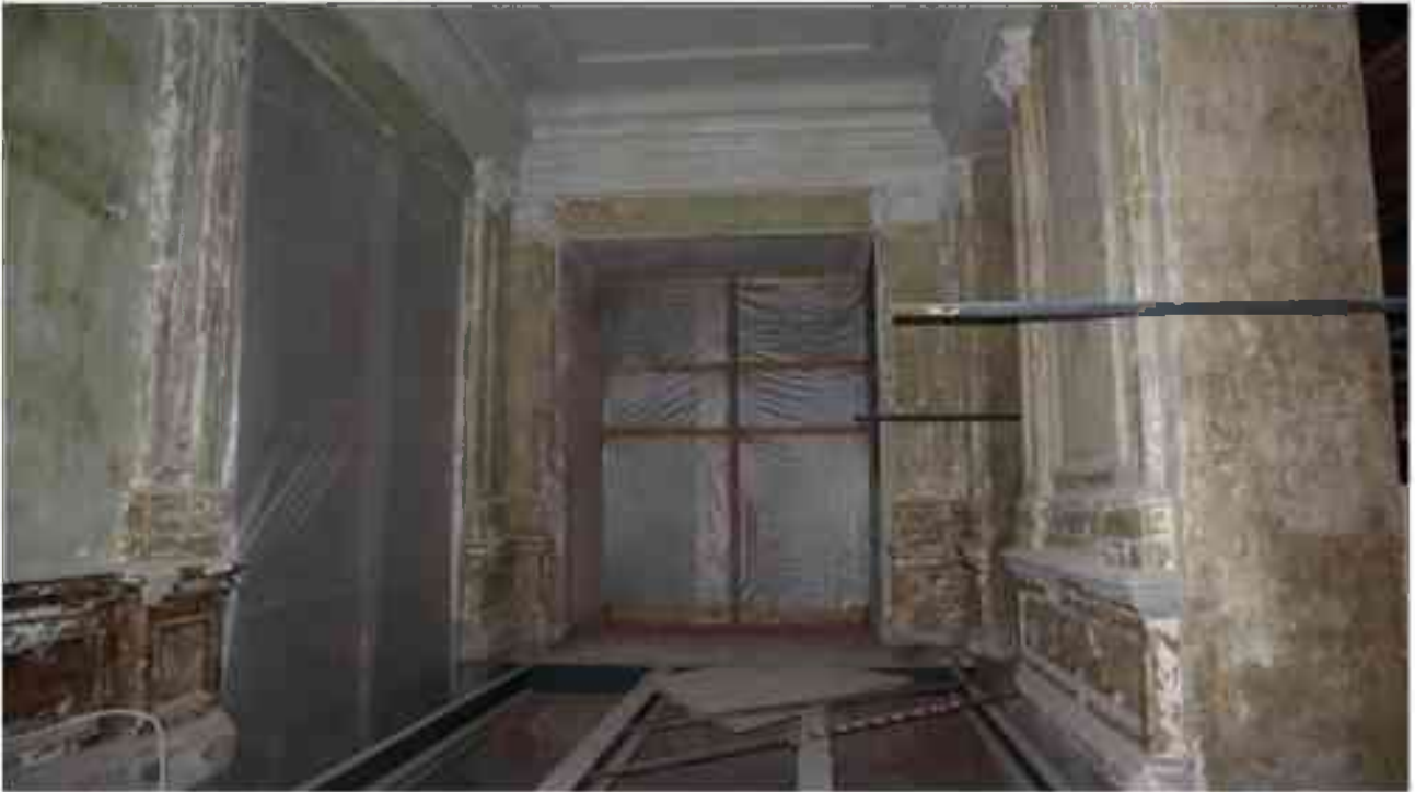
Фото 2.161. 2 этаж, помещение 22Н (20).
