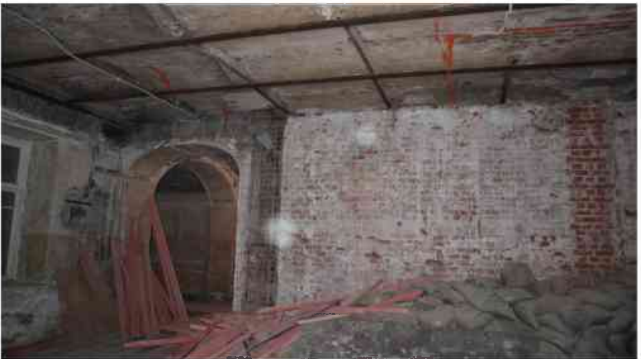
Фото 4.52. 4 этаж, помещение 33Н (23-28).
