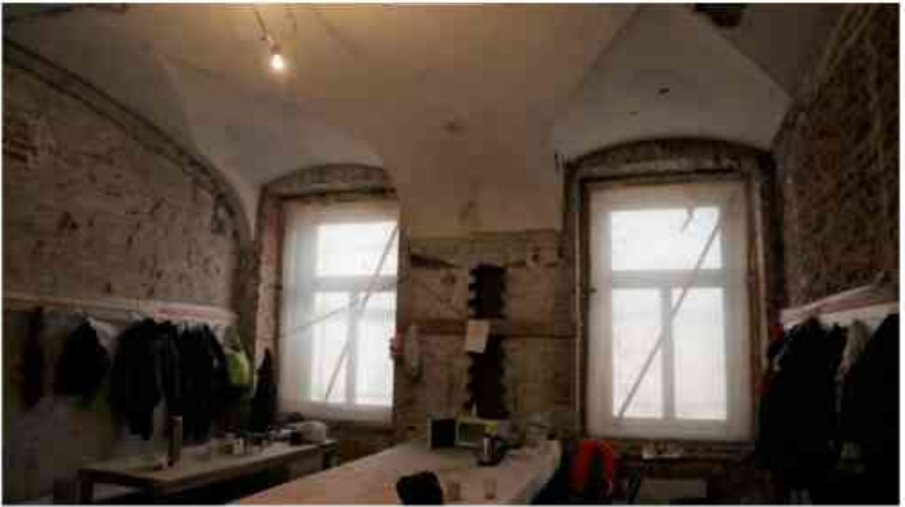
Фото 2.110. 2 этаж, помещение 22Н (55).
