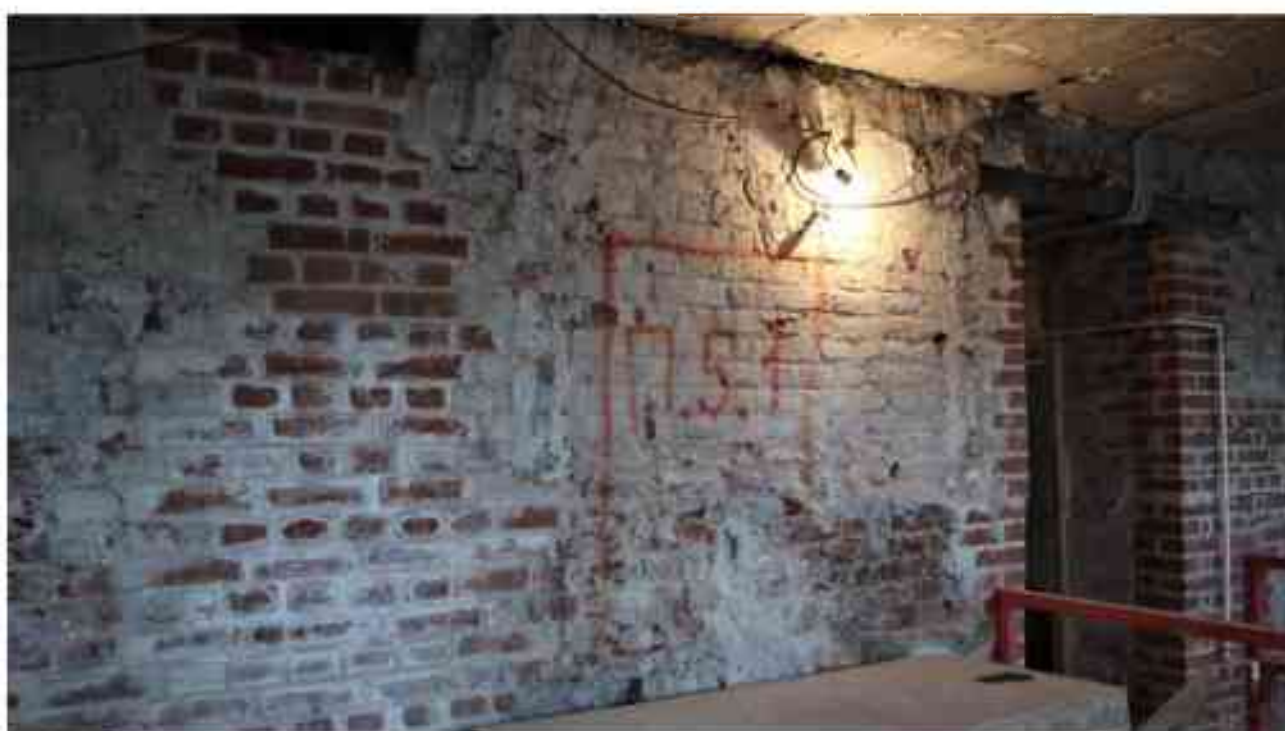
Фото 5.39. 5 этаж, помещение 38Н (1).
