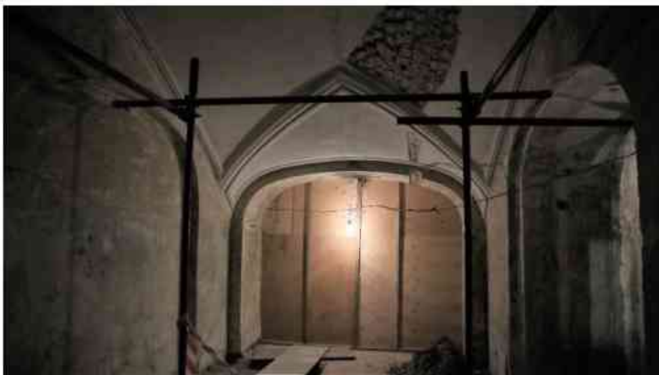
Фото 1.276. 1 этаж, помещение 13Н (24).
