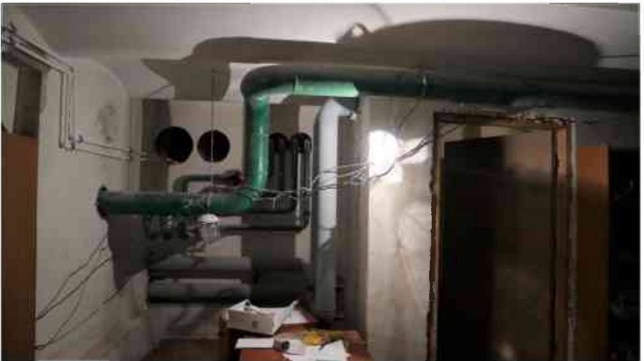
Фото п.119. Подвал, помещение 4Н (8-9).
