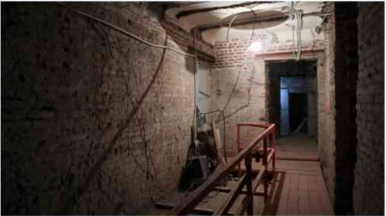
Фото 5.51. 5 этаж, помещение 35Н (13-14).
