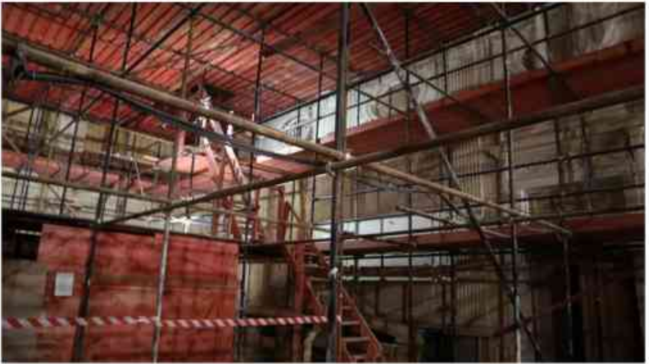
Фото 3.73. 3 этаж, помещение 28Н (2).
