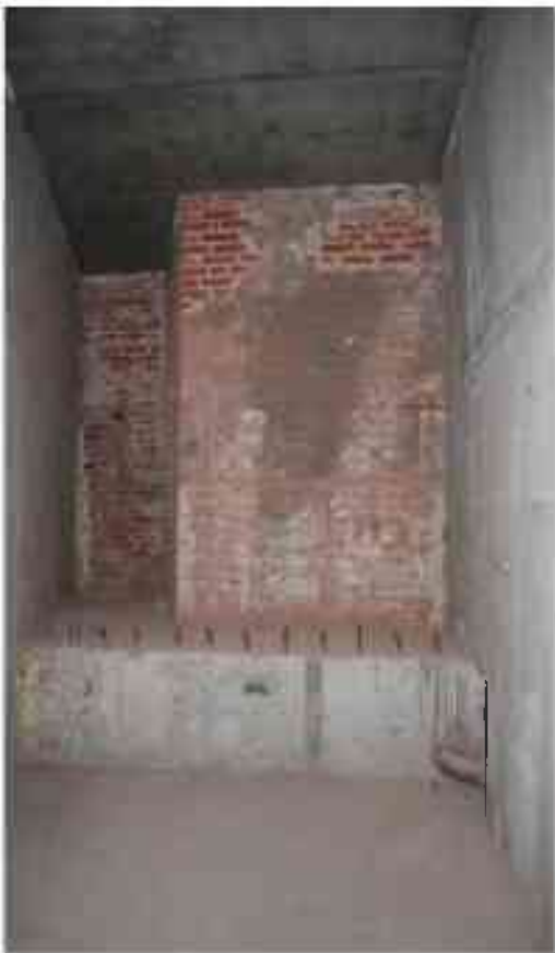
Фото п.42. Подвал, помещение 3Н (12).
