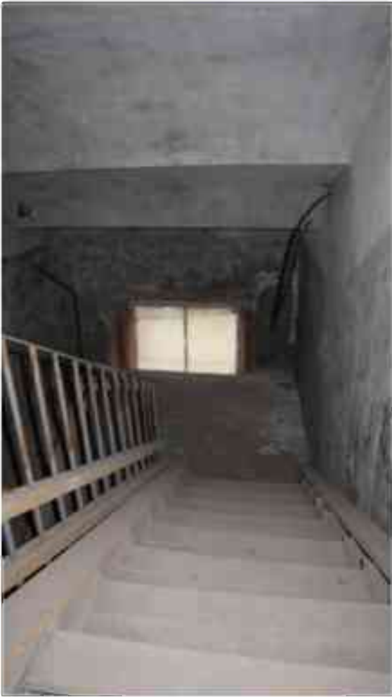
Фото 6.54. 6 этаж, лестница Л-17.
