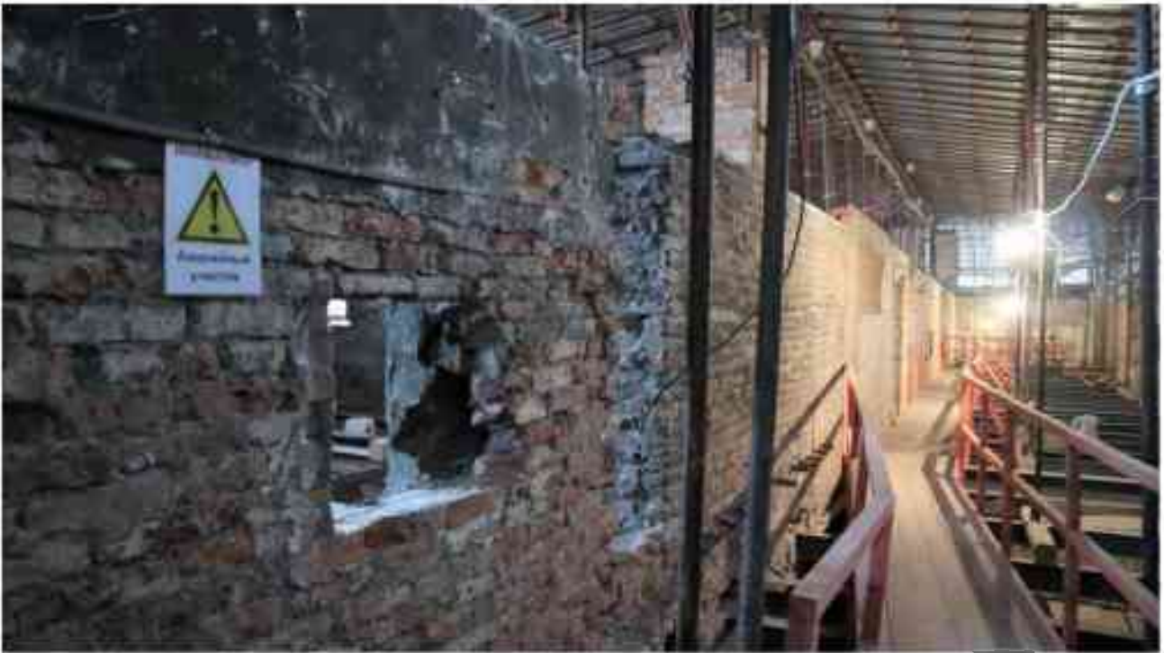
Фото 5.136. 5 этаж, коридор, помещения 34Н/37Н.
