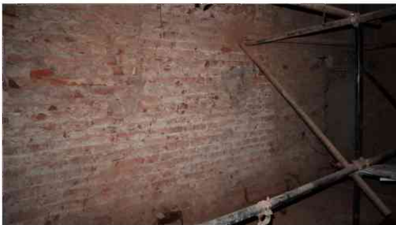
Фото 1.192. 1 этаж, помещение 17Н (3).
