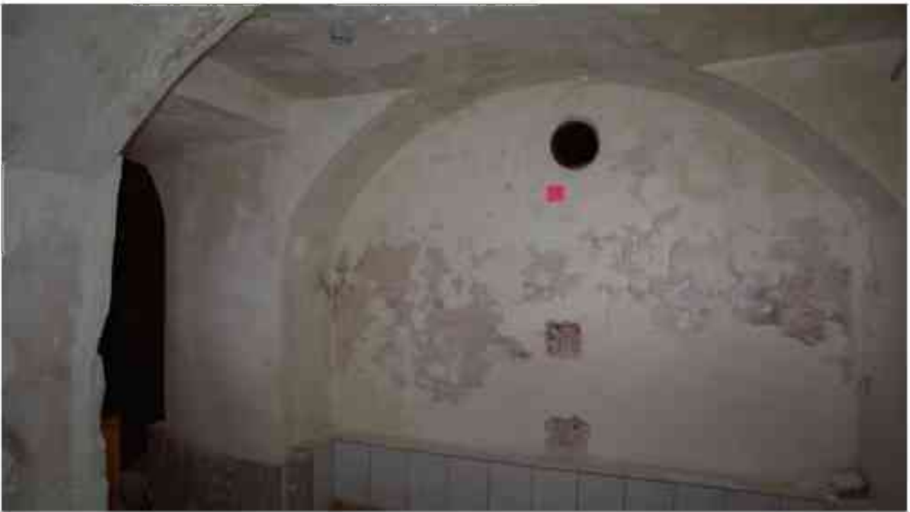
Фото п.155. Подвал, помещение 9Н (16).
