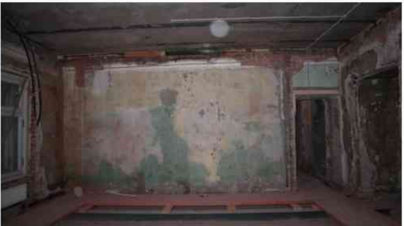
Фото 4.90. 4 этаж, помещение 33Н (8-10).
