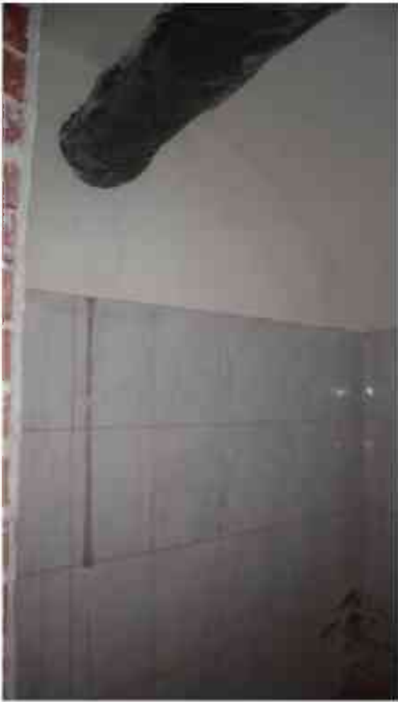
Фото п.265. Подвал, помещение 6Н (5-6).
