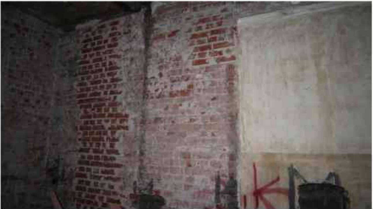
Фото 4.50. 4 этаж, помещение 33Н (23-28).
