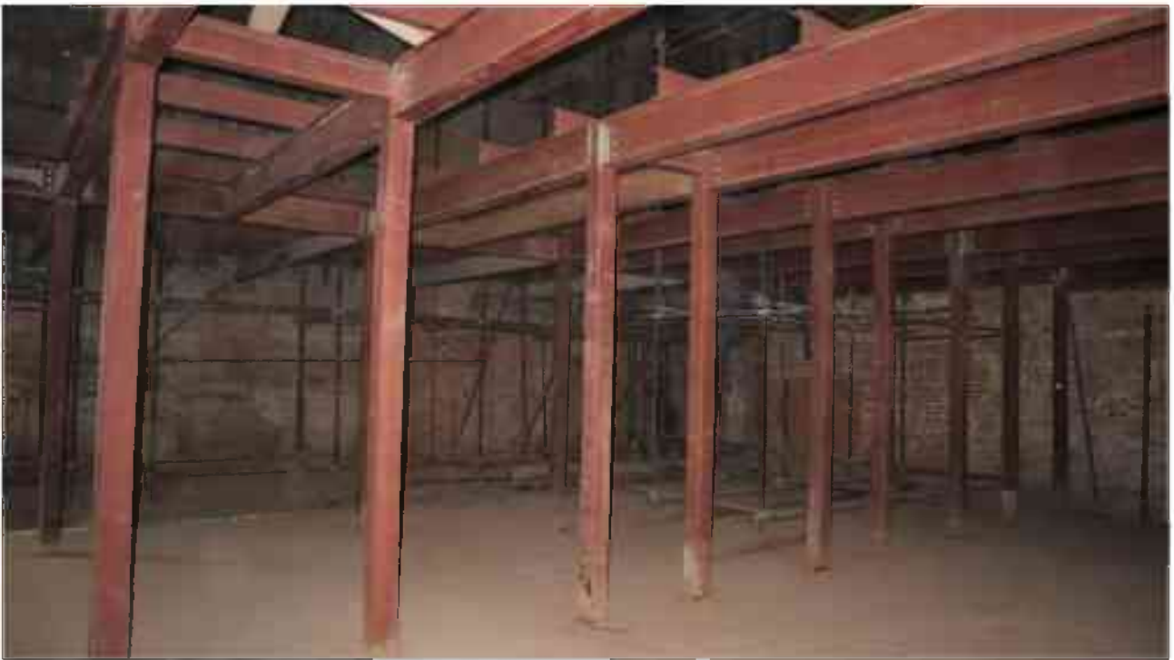
Фото 1.194. 1 этаж, помещение 17Н (1).
