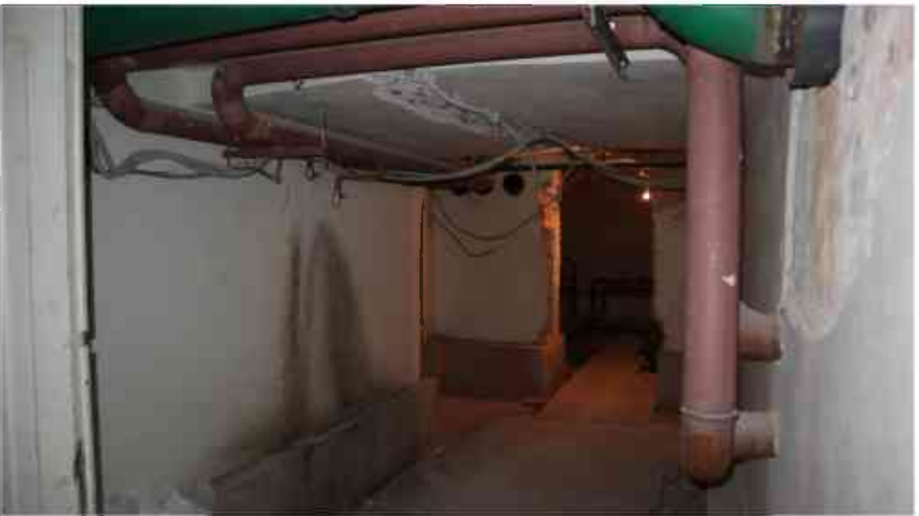
Фото п.185. Подвал, помещение 9Н (8).
