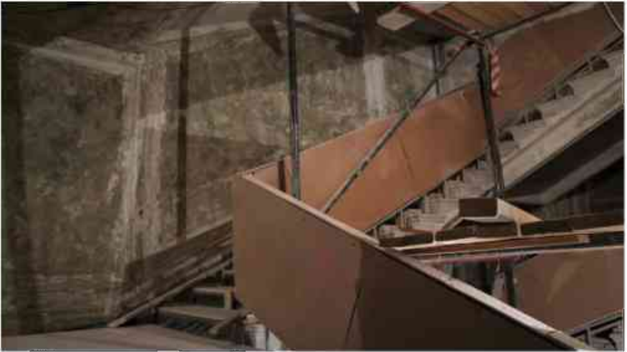
Фото 2.176. 2 этаж, лестница в ризалите южного фасада (западная часть).*
