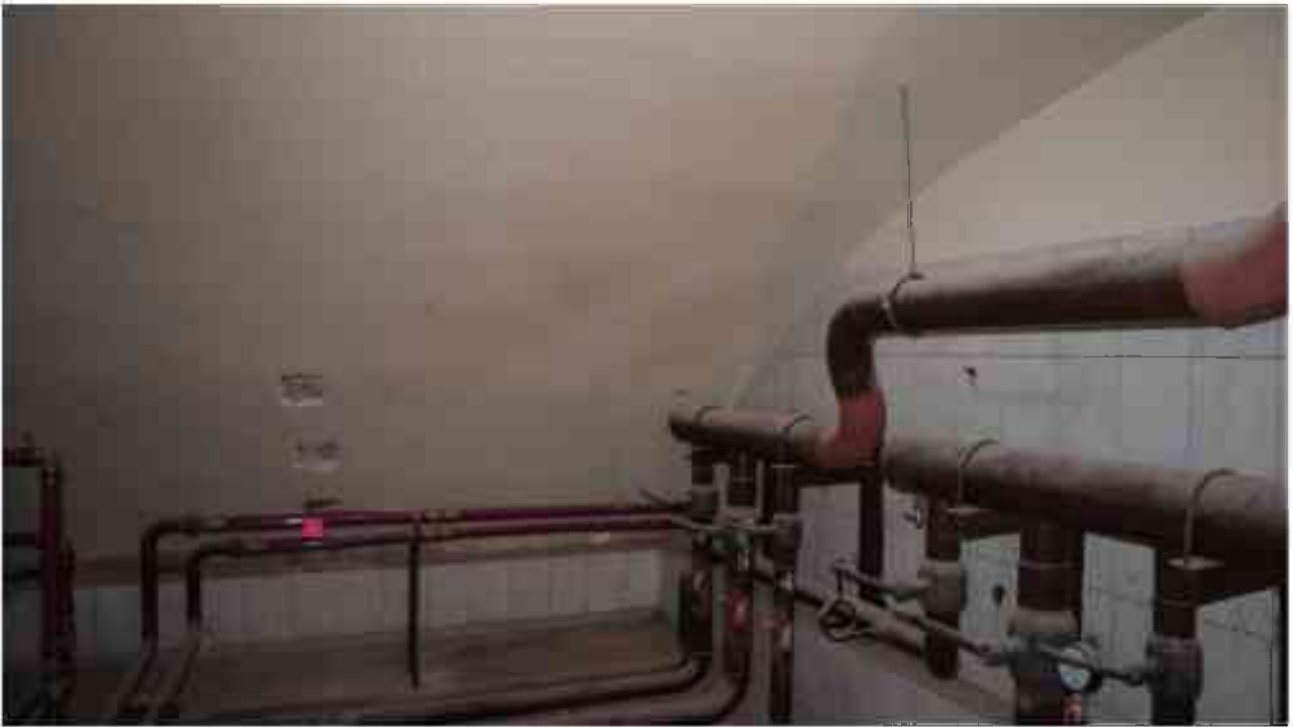
Фото п.166. Подвал, помещение 9Н (10).
