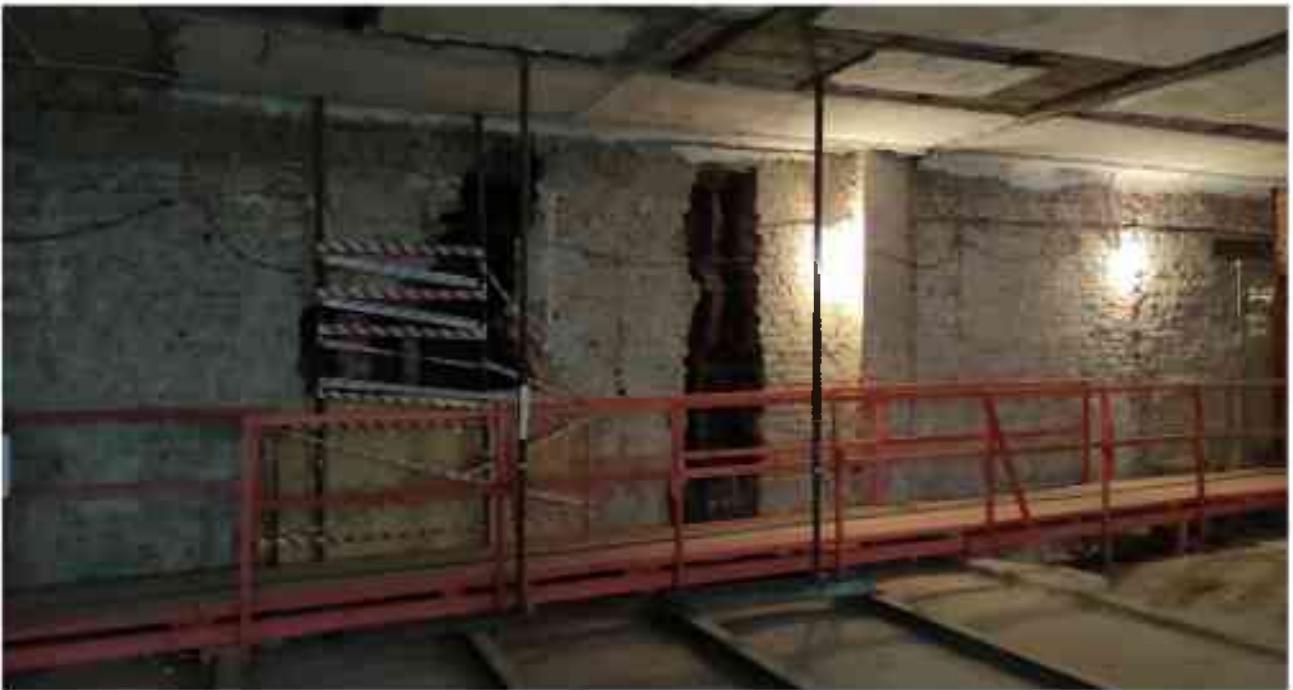
Фото 5.93. 5 этаж, помещение 34Н(3-11).
