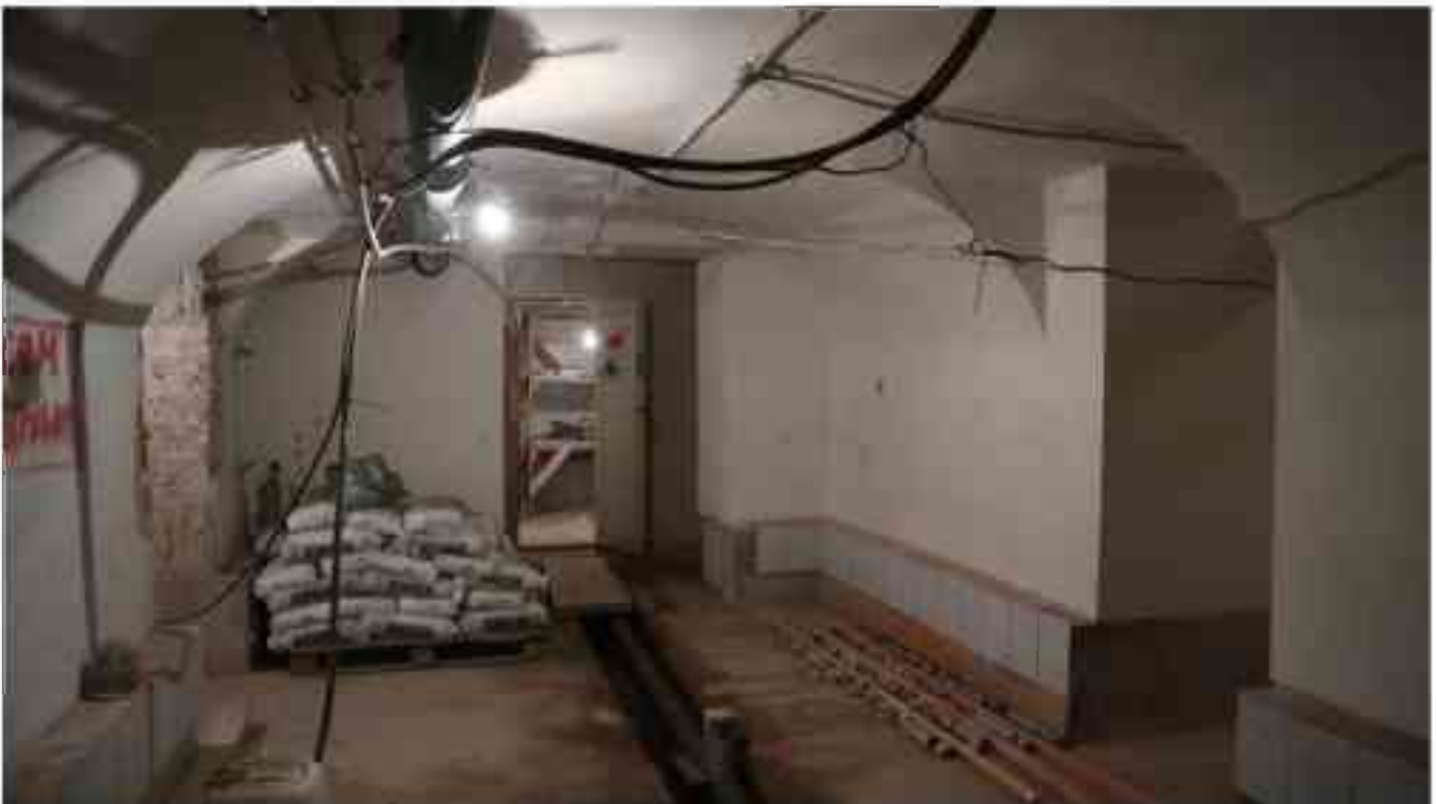
Фото п.248. Подвал, помещение 6Н (1-2).
