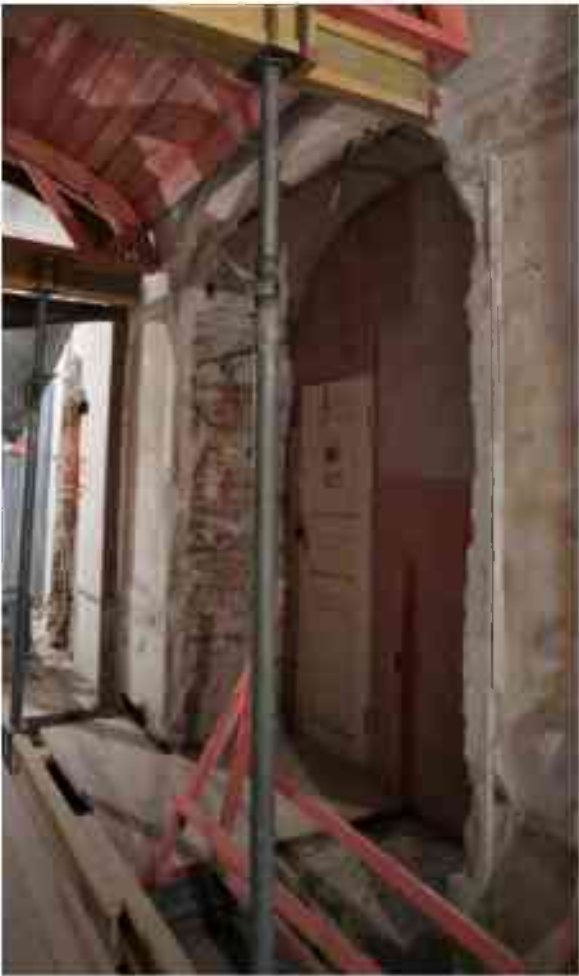
Фото 1.78. 1 этаж, помещение 14Н (24).
