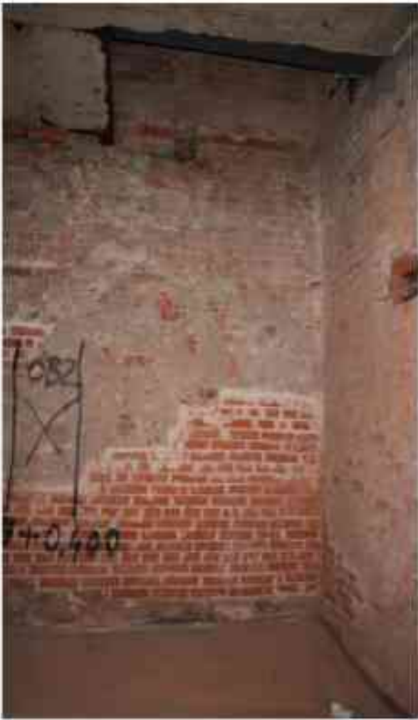
Фото 1.90. 1 этаж, помещение 14Н (36-42).
