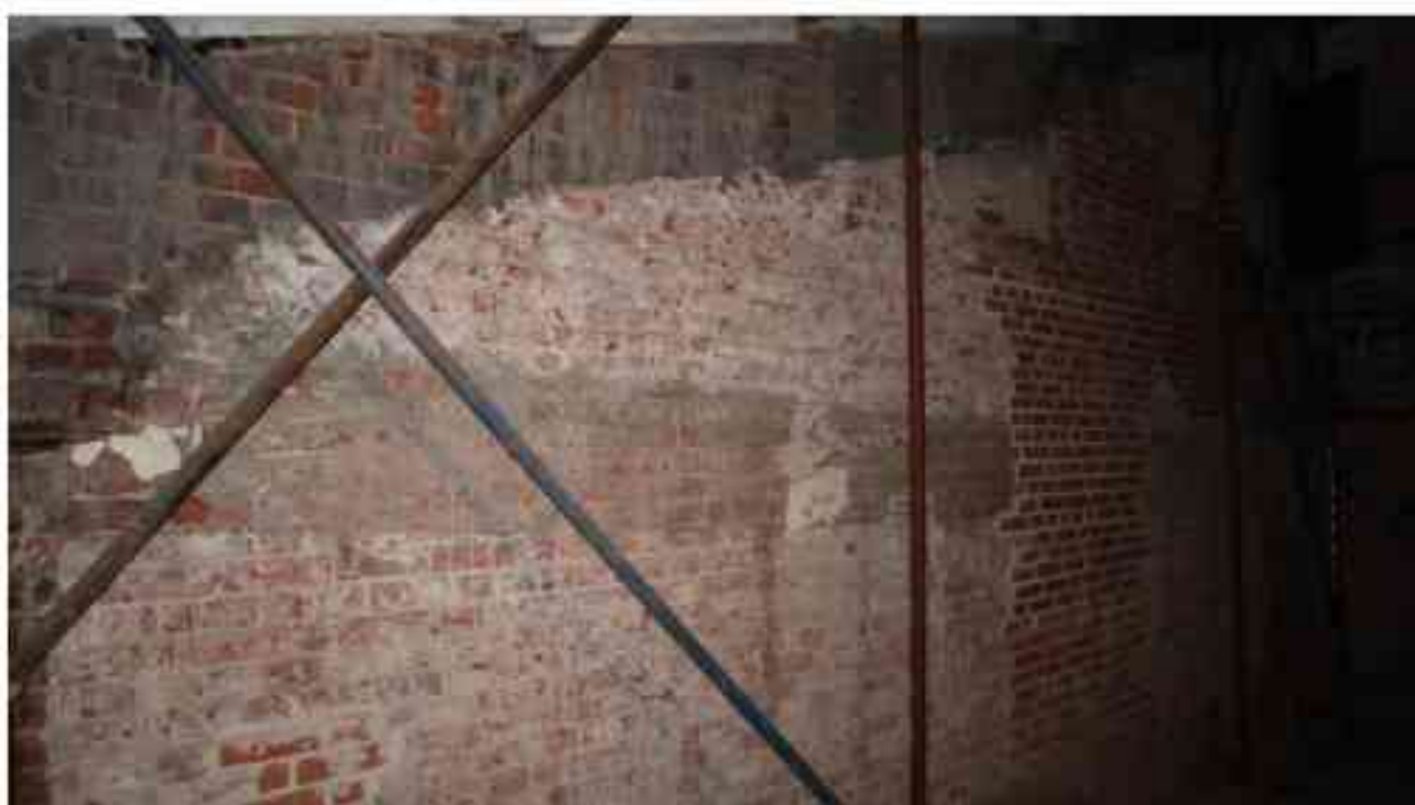
Фото 5.125. 5 этаж, коридор, помещения 34Н/37Н.
