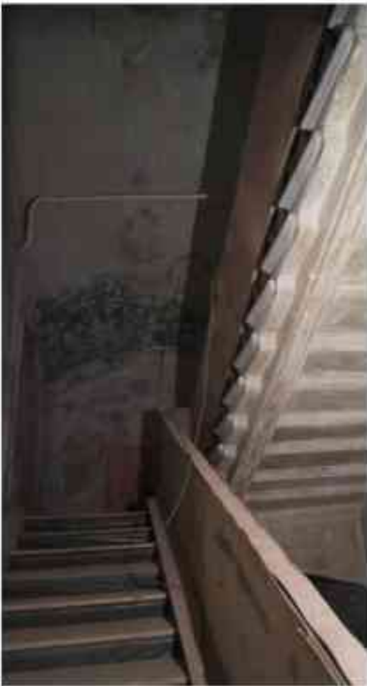
Фото 5.194. 5 этаж, лестница Л-21.
