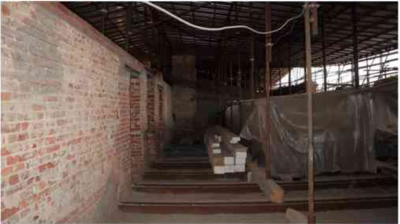
Фото 5.170. 5 этаж, чердачное помещение.
