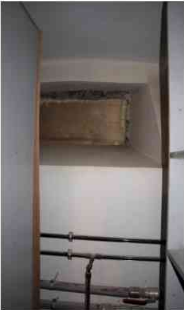
Фото п.120. Подвал, помещение 4Н (8-9).
