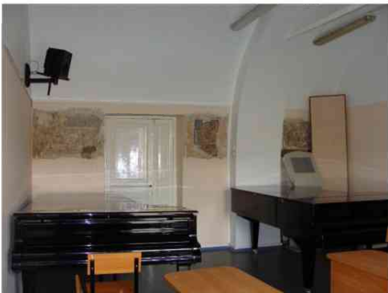
Ил. 240. Здание С.-Петербургской Консерватории им. Н. А. Римского-Корсакова. Класс в помещении IV-28. /Бывший объем церкви/. Фото 2012 года.
