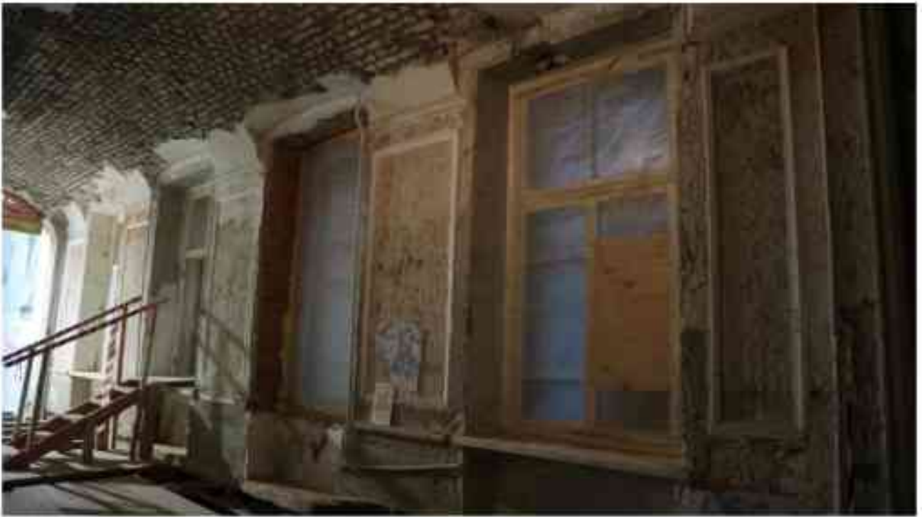
Фото 2.13. 2 этаж, помещение 22Н (64-67).
