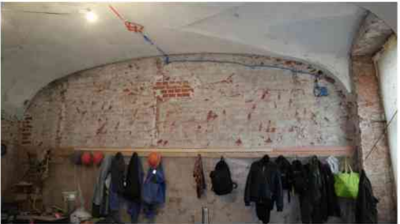
Фото 2.111. 2 этаж, помещение 22Н (55).
