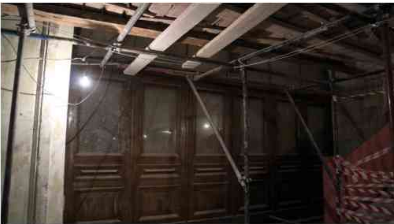
Фото 1.333. 1 этаж, помещение 13Н (30).
