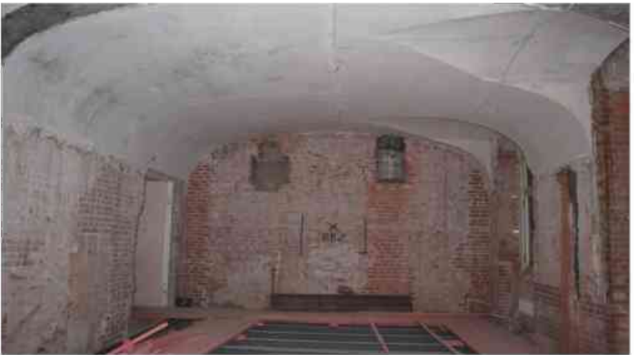
Фото 2.12. 2 этаж, помещение 22Н (45-46).
