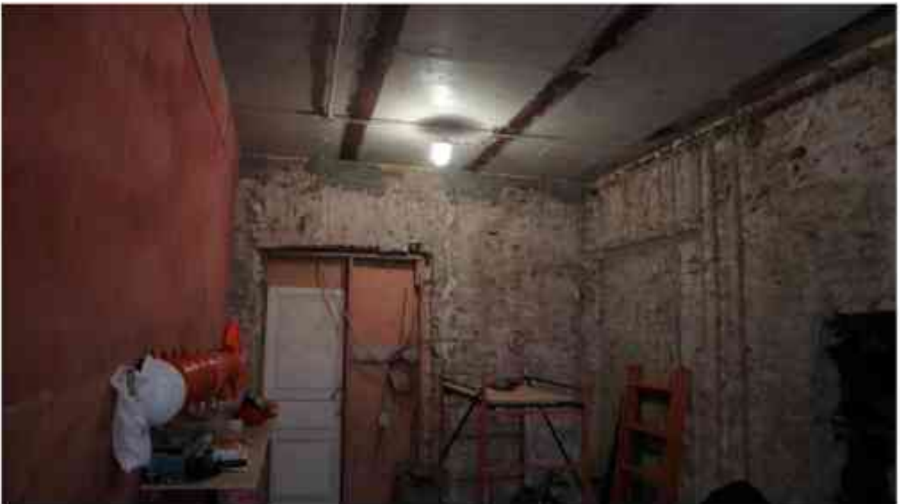
Фото 4.82. 4 этаж, помещение 33Н (4).
