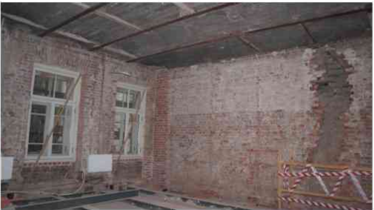
Фото 2.30. 2 этаж, помещение 22Н (68-72, 74-75).
