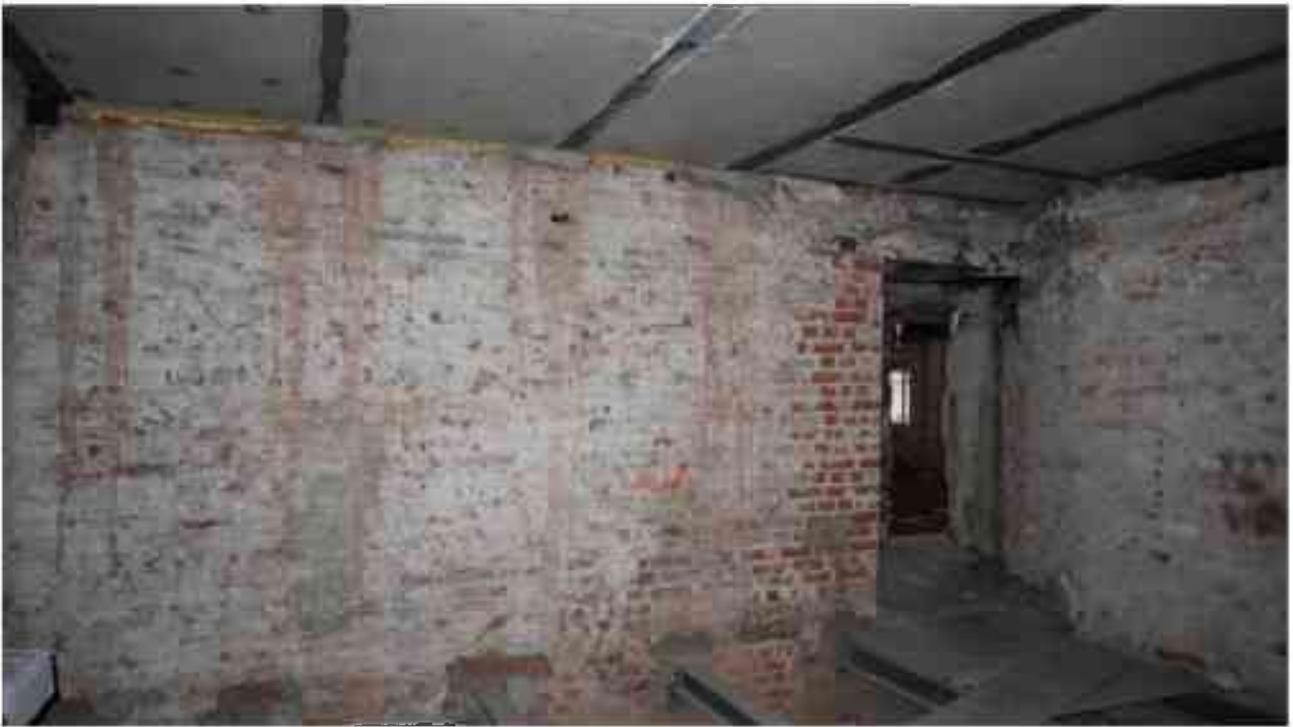
Фото 5.156. 5 этаж, жилой блок, на плане ПИБ 2000г. обозначен как квартиры, помещение (1-2).
