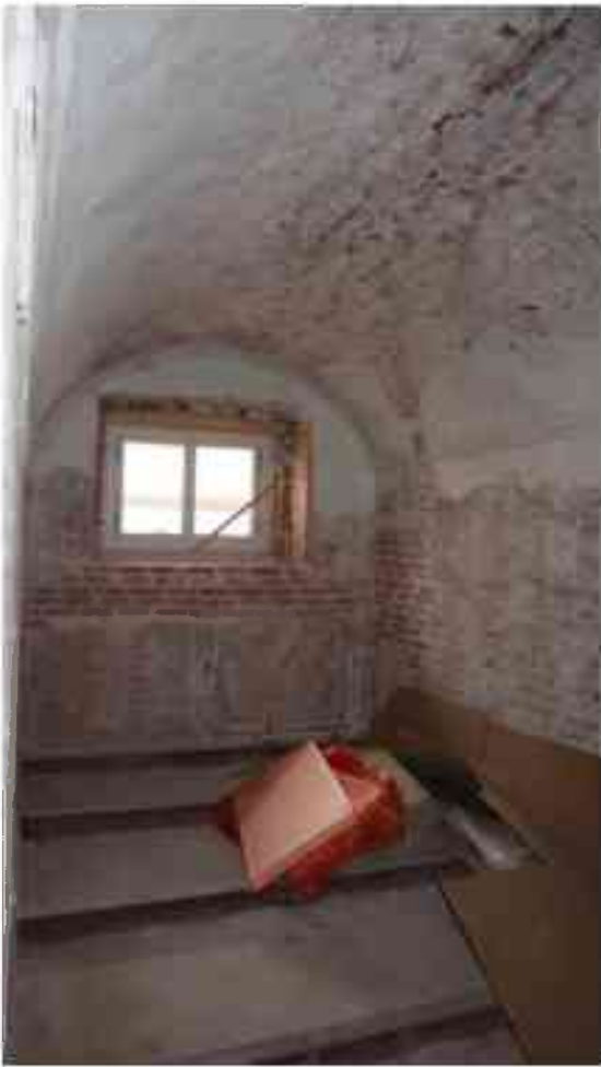
Фото 5.28. 5 этаж, помещение 35Н (20, 22).
