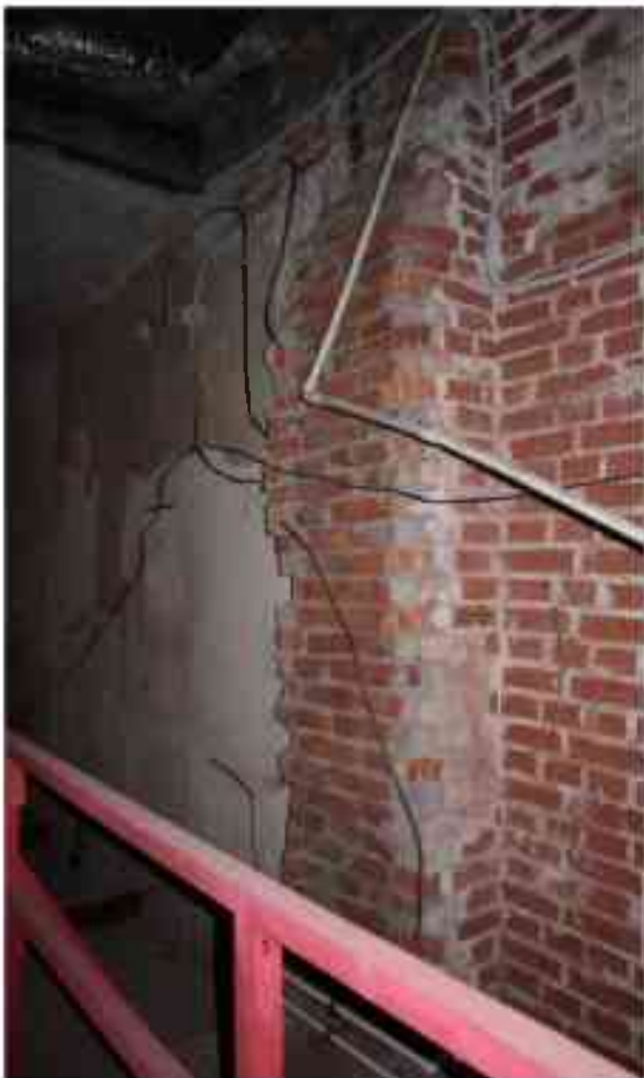
Фото 5.70. 5 этаж, помещение 35Н (4-6).
