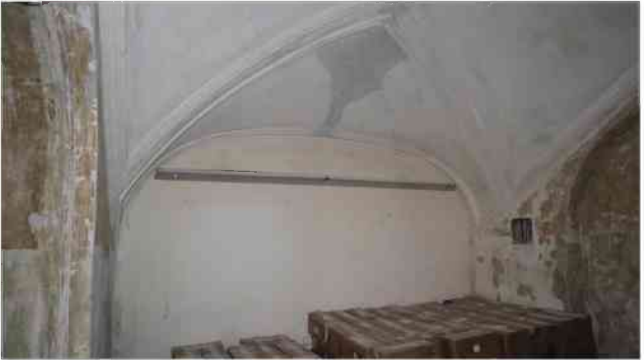
Фото 1.258. 1 этаж, помещение 13Н (34).
