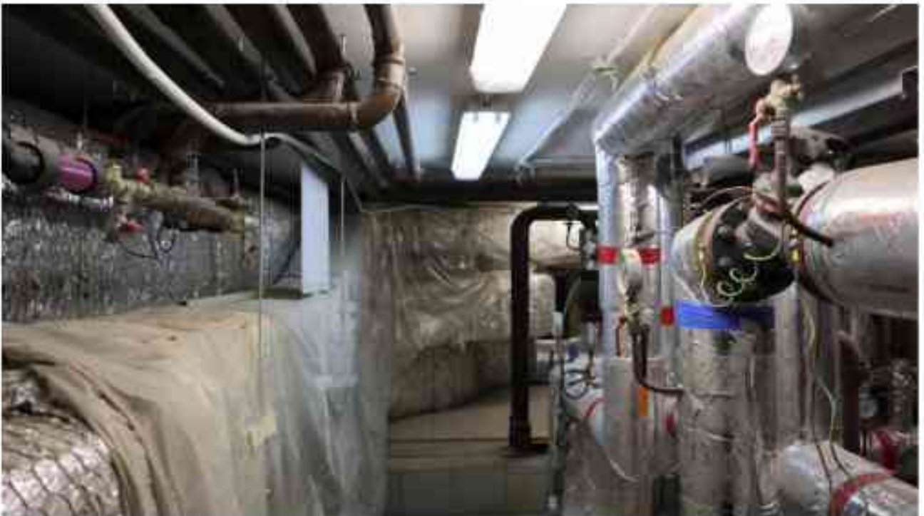
Фото п.325. Подвал, помещение 18Н (10-12).
