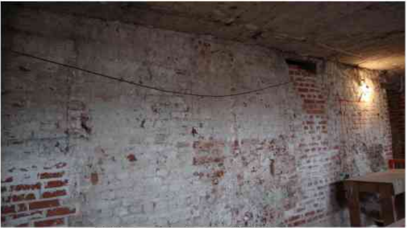
Фото 5.40. 5 этаж, помещение 38Н (1).
