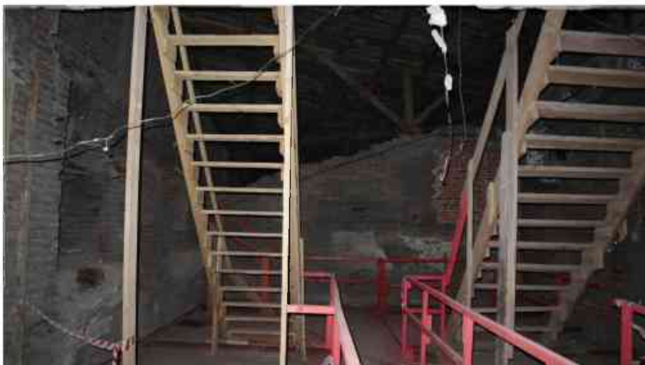
Фото 5.72. 5 этаж, помещение 35Н (4-6).
