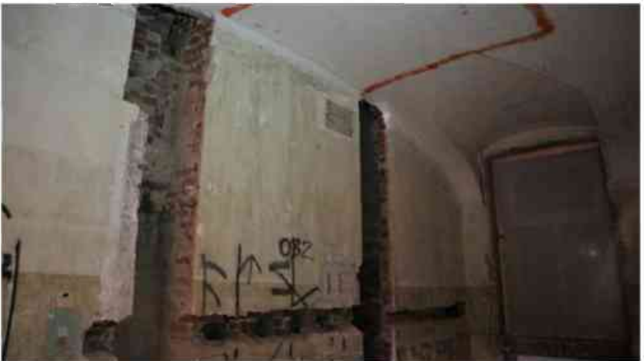
Фото 3.57. 3 этаж, помещение 28Н (14-17).
