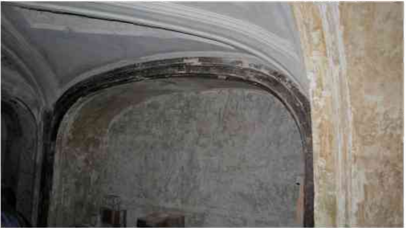
Фото 1.260. 1 этаж, помещение 13Н (34).
