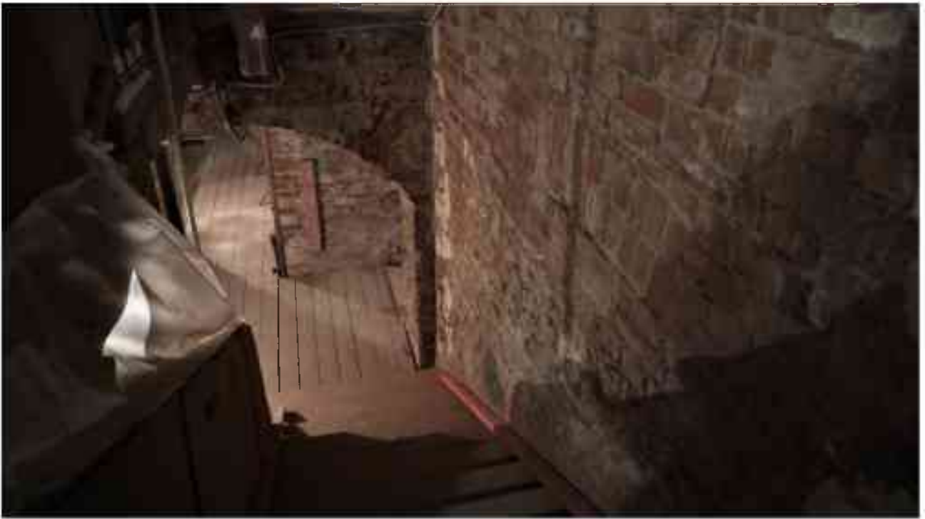
Фото п.1. Подвал, лестница Л-6.
