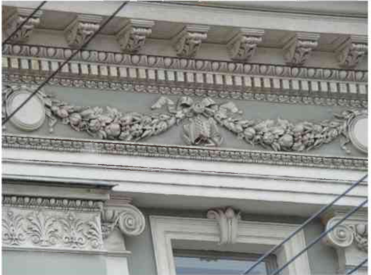
Ил. 213. Здание С.-Петербургской Консерватории им. Н. А. Римского-Корсакова. Фрагмент верхней части восточного ризалита северного фасада. Капитель пилястры, верхняя часть наличника окна четвертого этажа и антаблемент. Фото 2012 года.
