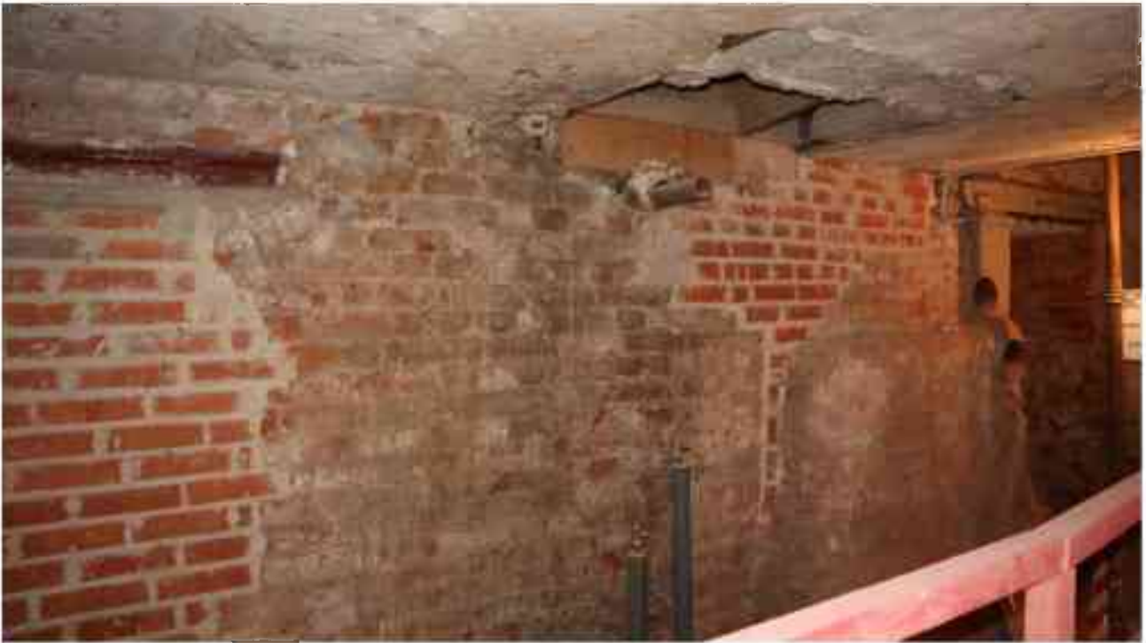
Фото п.338. Подвал, помещение 18Н (3-4).
