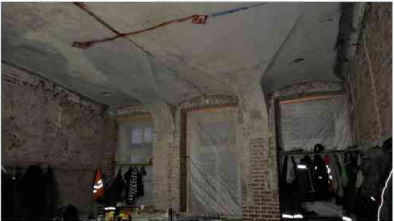
Фото 2.48. 2 этаж, помещение 22Н (62).
