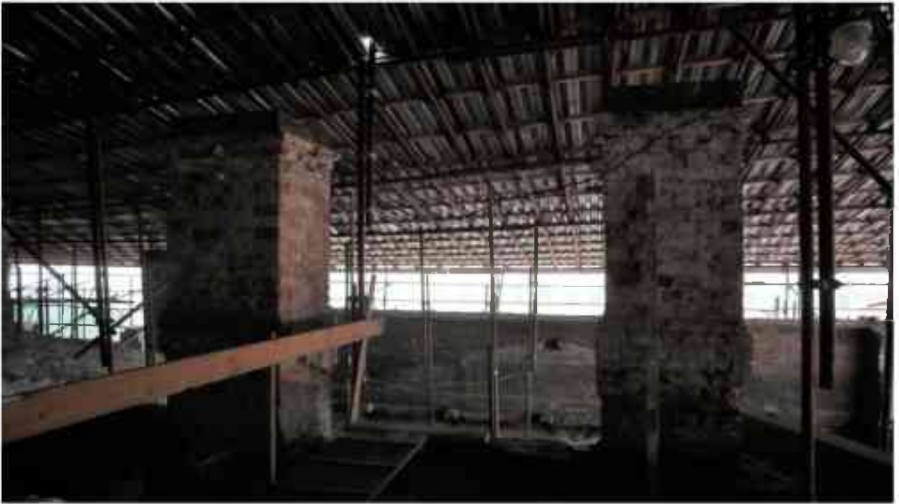
Фото 6.38. 6 этаж, чердачное помещение.
