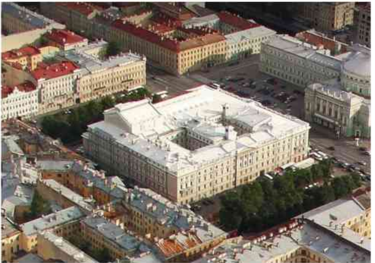
266. Вид на здание Консерватории 2011 г. Видны надстройки со стороны дворов и изменение ската крыши.
