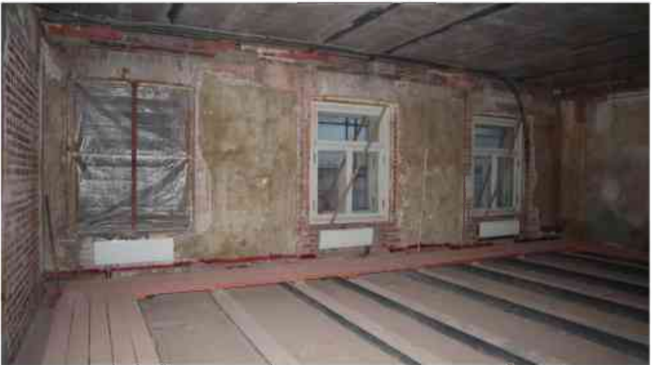
Фото 4.88. 4 этаж, помещение 33Н (8-10).
