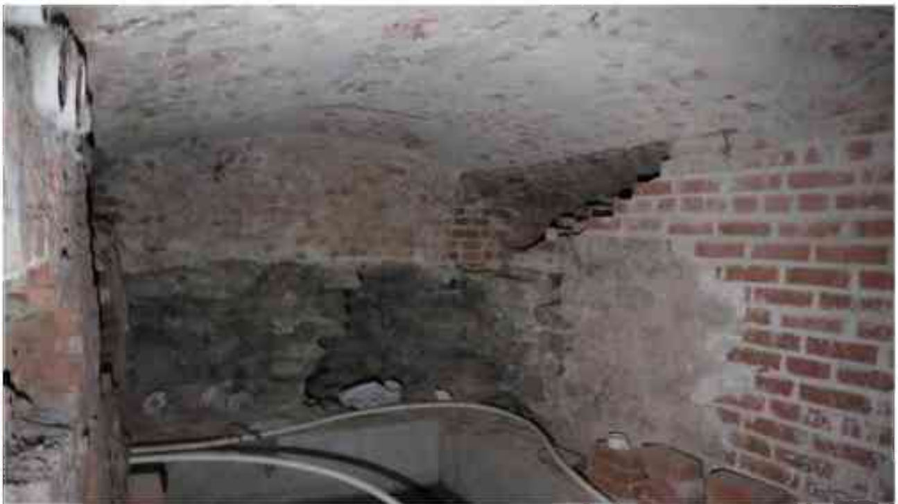
Фото п.296. Подвал, помещение 7Н (1).
