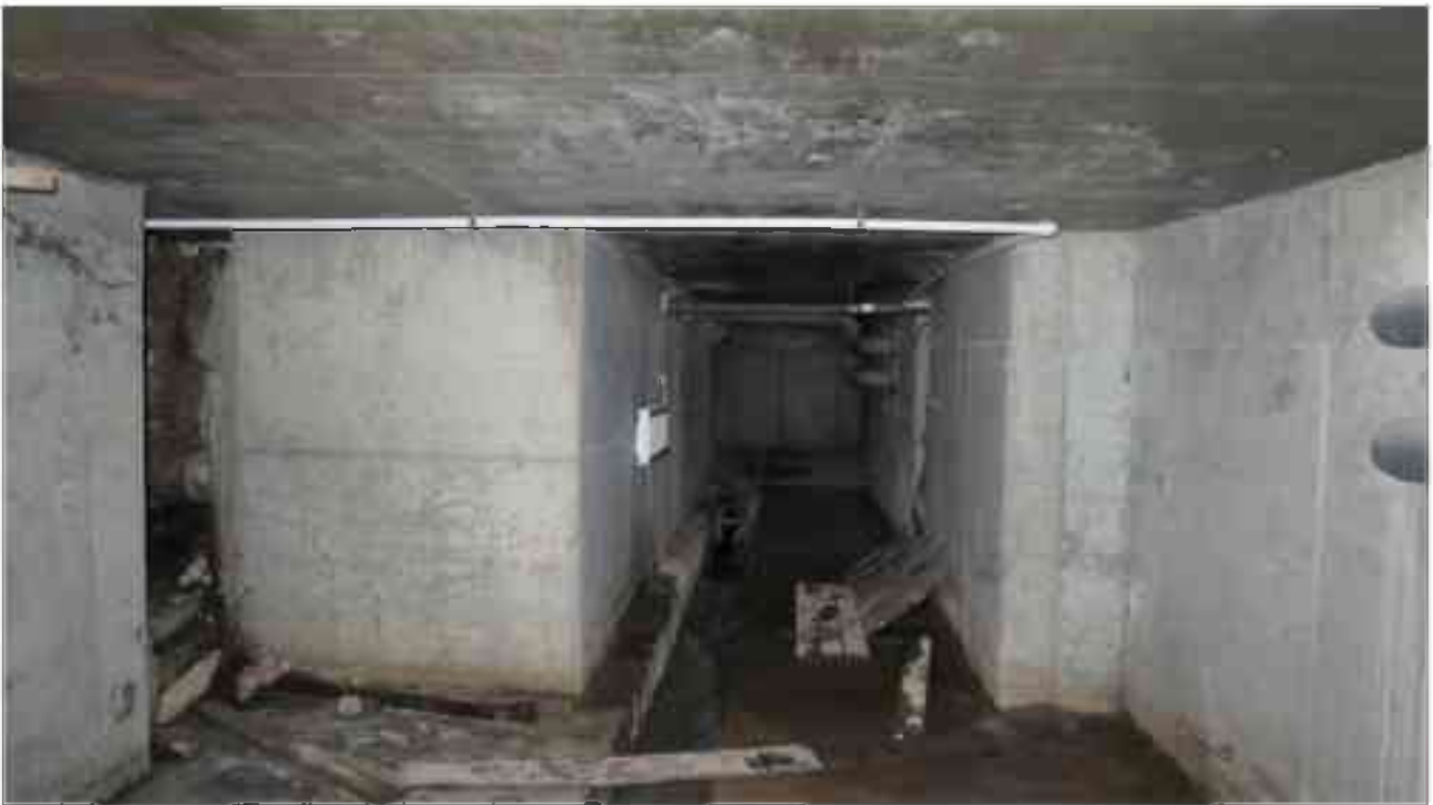
Фото п.104. Подвал, помещение под аркой восточного двора.*
