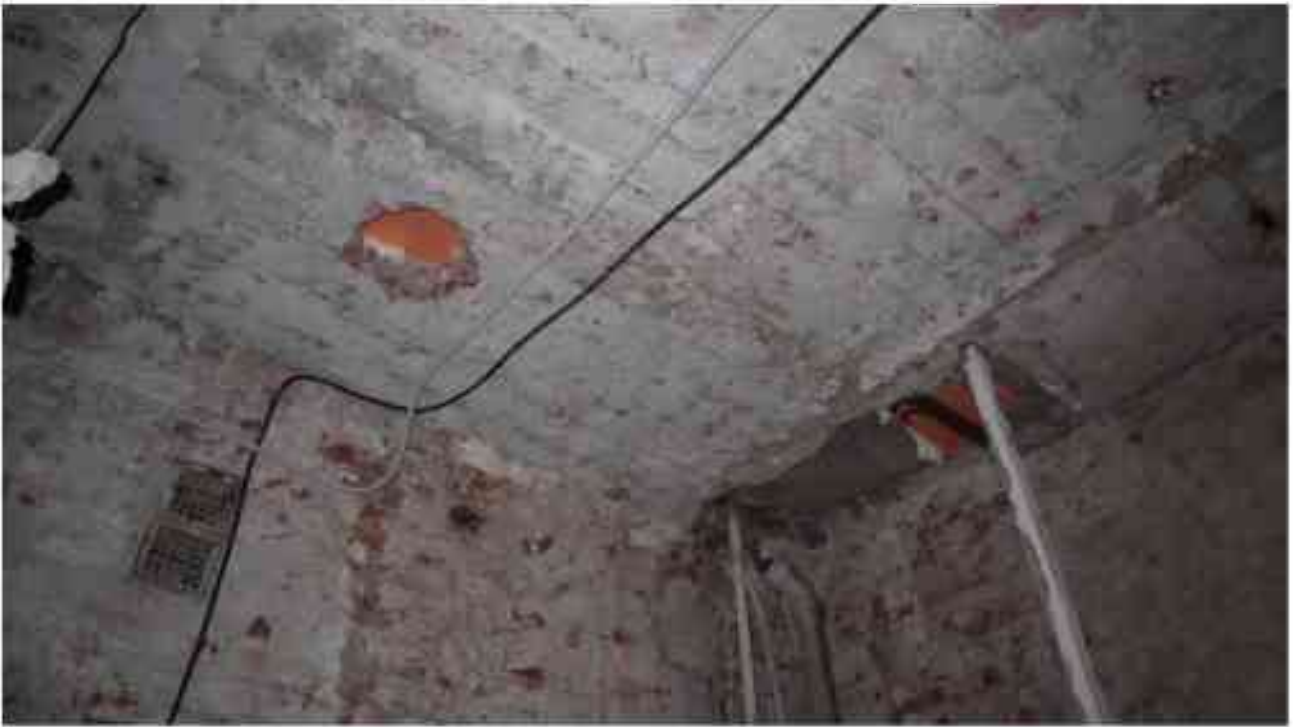
Фото 4.121. 4 этаж, коридор, помещение 29Н (3-4).
