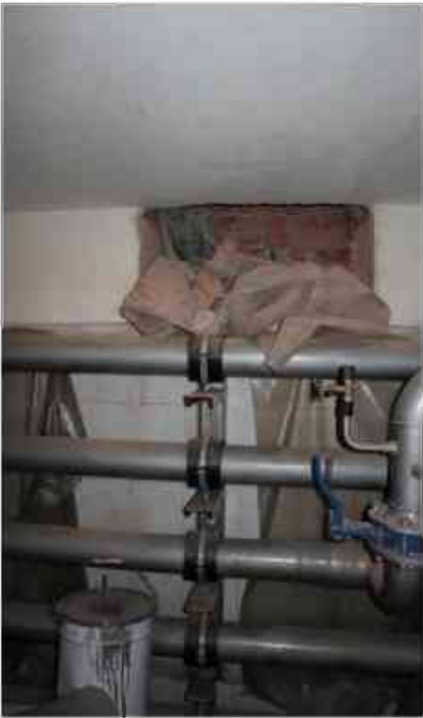
Фото п.308. Подвал, помещение 3Н (16).
