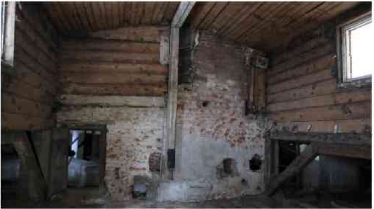
Фото 6.56. 6 этаж, чердачное помещение.
