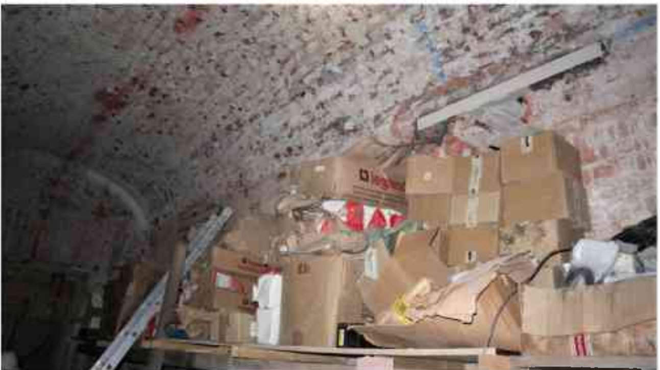
Фото 2.116. 2 этаж, помещение 22Н (51).
