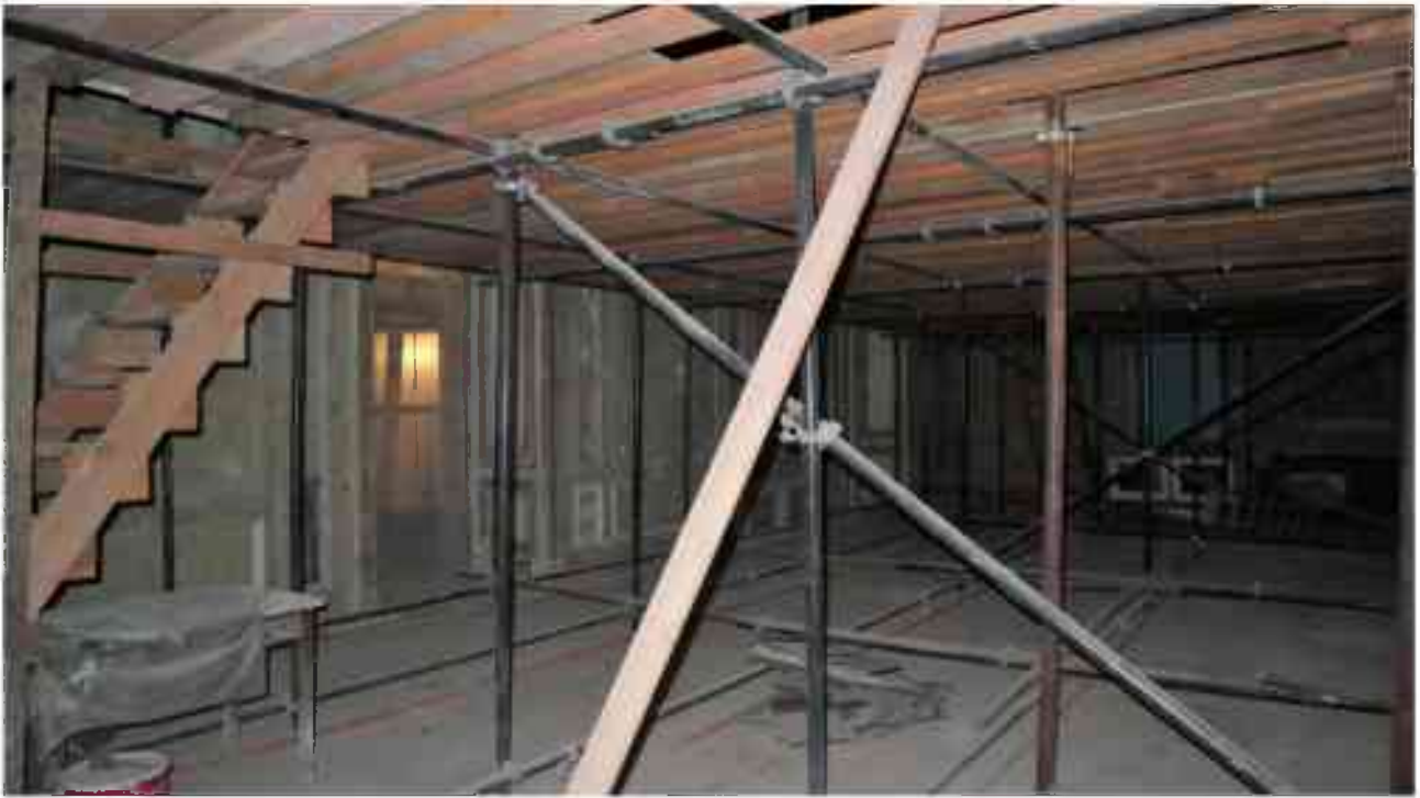
Фото 3.91. 3 этаж, помещение 28Н (12).
