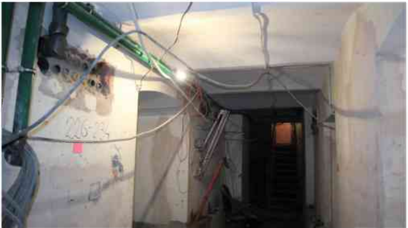
Фото п.90. Подвал, помещение 4Н (2).
