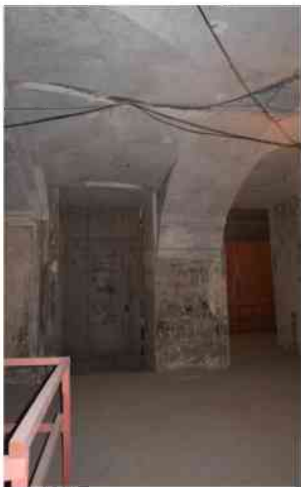
Фото 1.299. 1 этаж, помещение 13Н (4).
