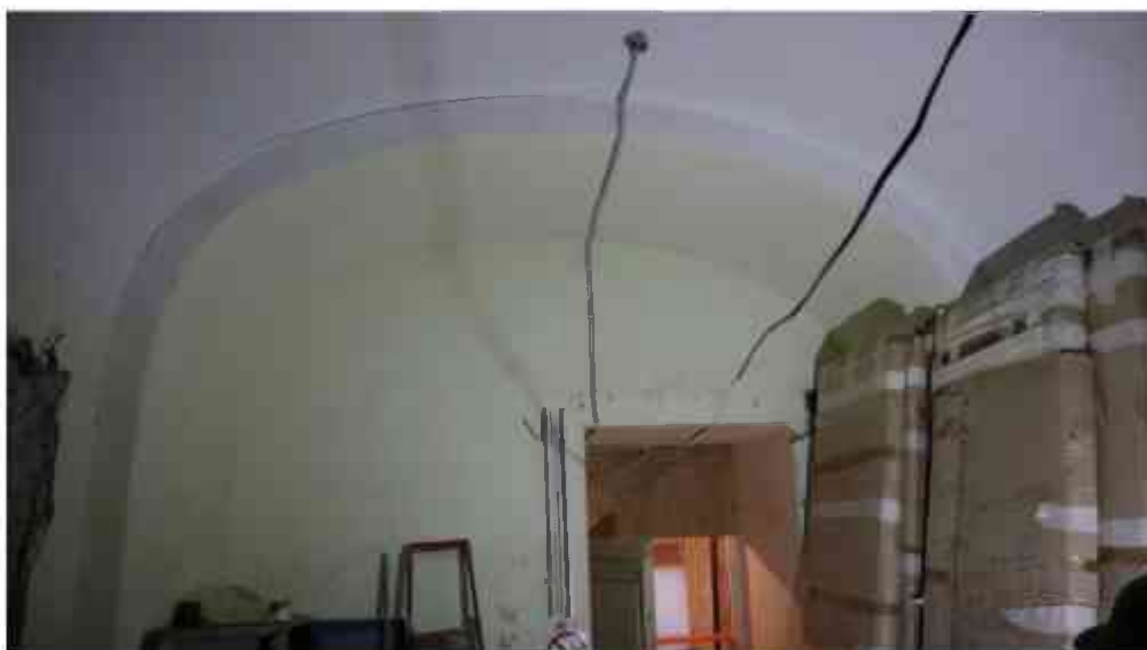
Фото 1.77. 1 этаж, помещение 14Н (25-26).
