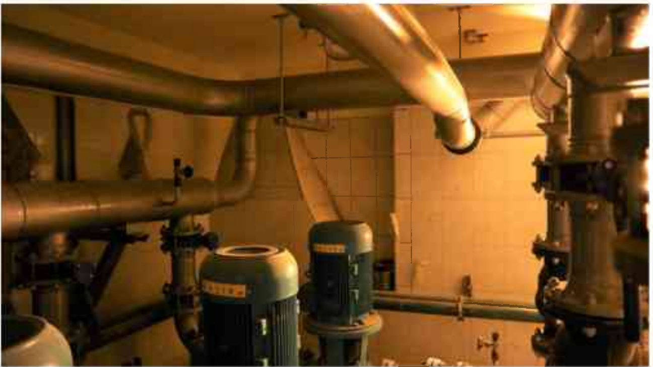
Фото п.311. Подвал, помещение 3Н (16).
