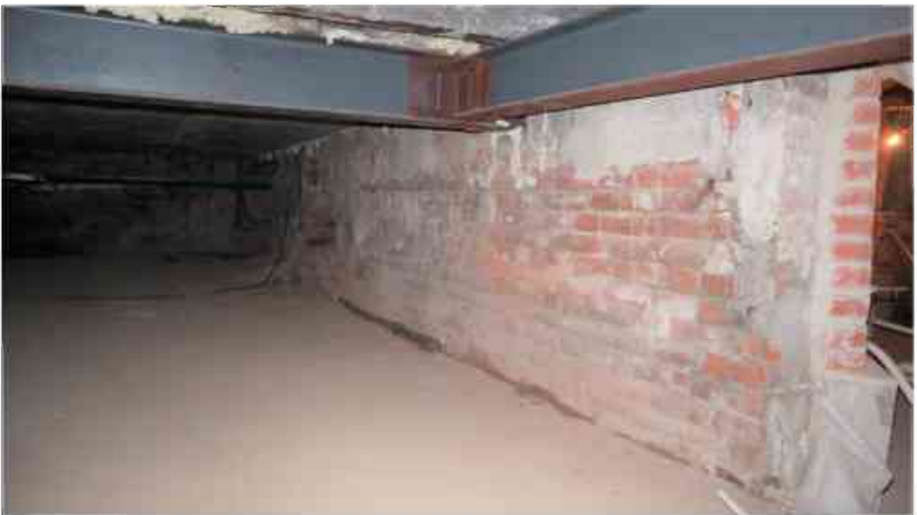
Фото п.300. Подвал, помещение 3Н (16).
