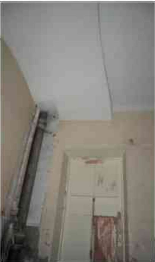
Фото 2.65. 2 этаж, помещение 22Н (26).
