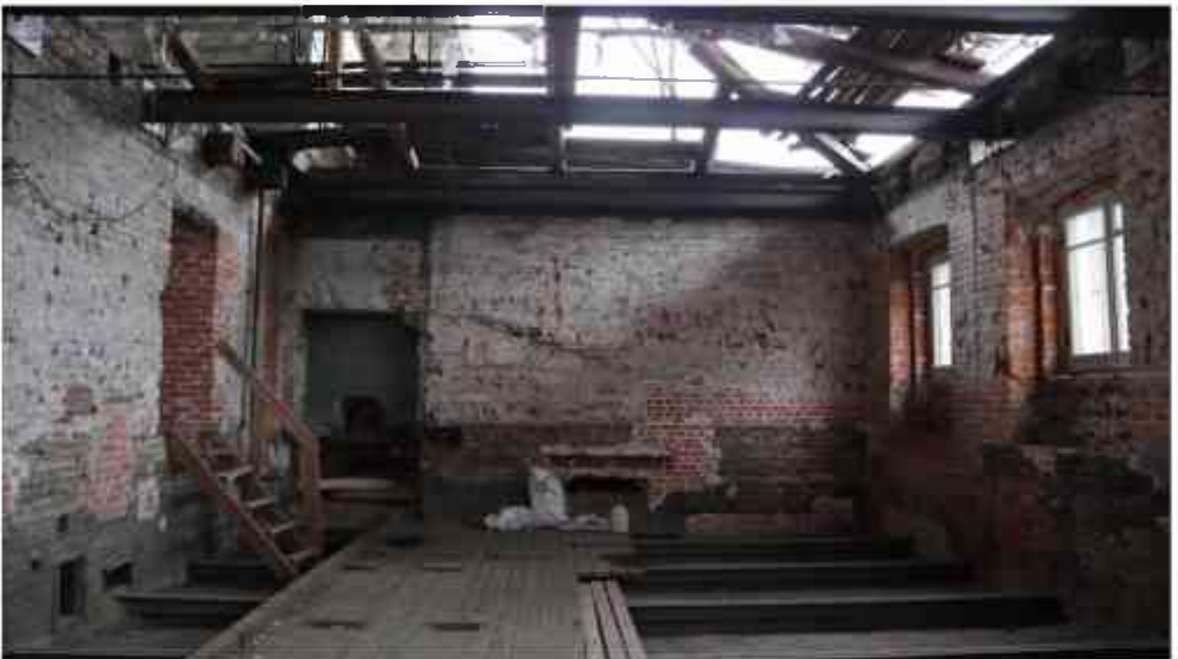
Фото 5.143. 5 этаж, жилой блок, на плане ПИБ 2000г. обозначен как квартиры, помещение (9-19).
