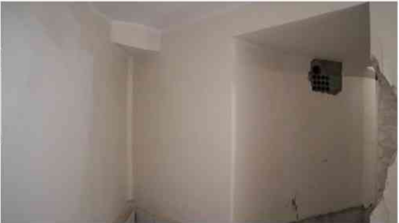
Фото п.115. Подвал, помещение 4Н (18).
