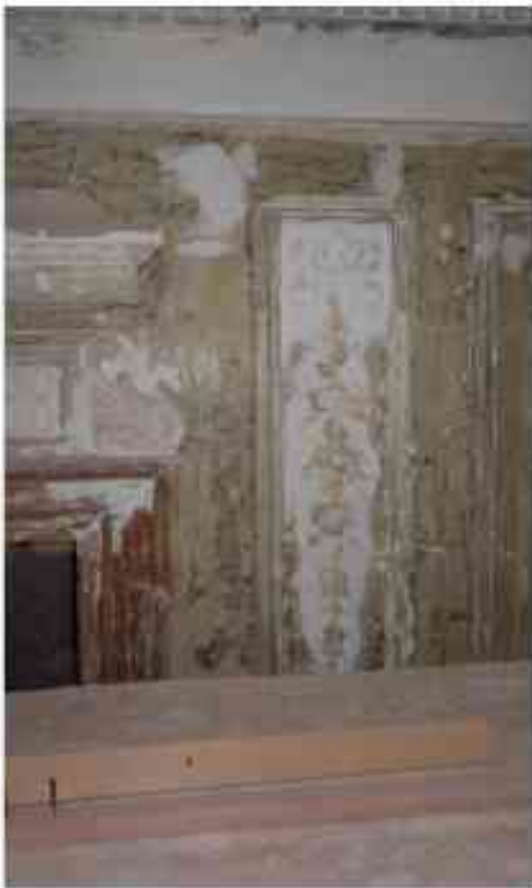
Фото 3.93. 3 этаж, помещение 28Н (12).*
