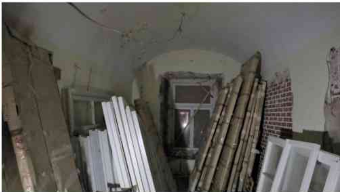
Фото 1.75. 1 этаж, помещение 14Н (25-26).
