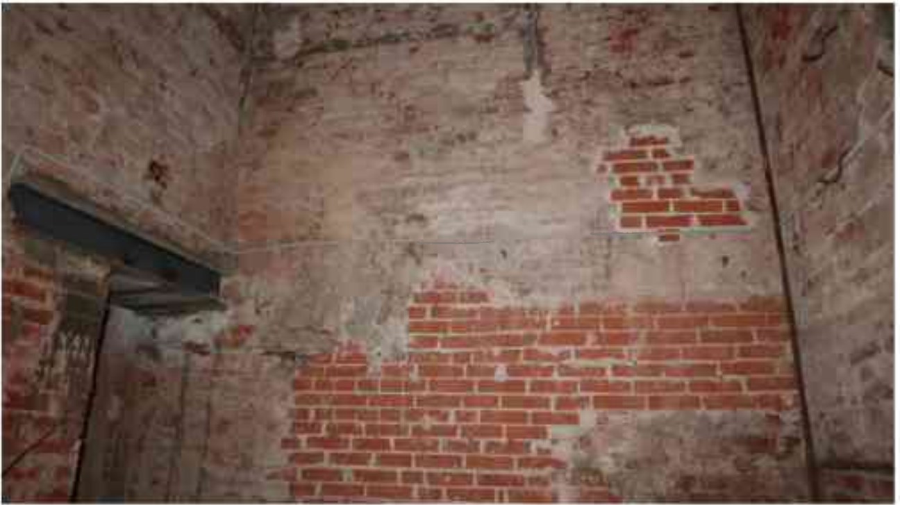
Фото п.68. Подвал, лестница Л-3.
