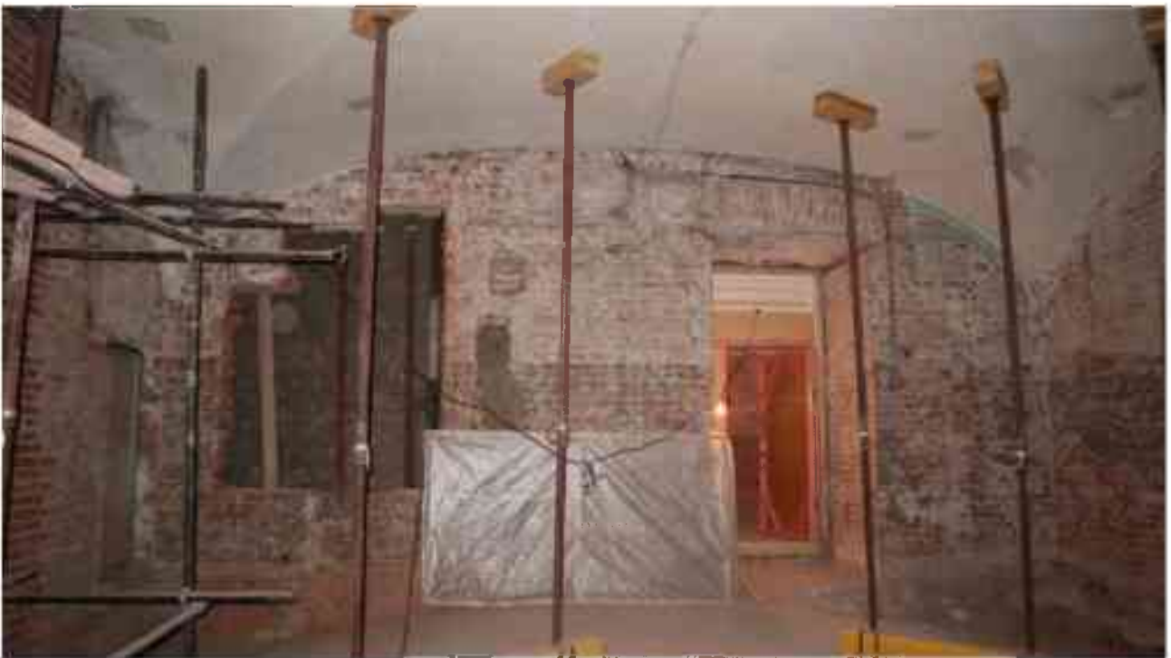
Фото 2.60. 2 этаж, помещение 22Н (37, 87-89).
