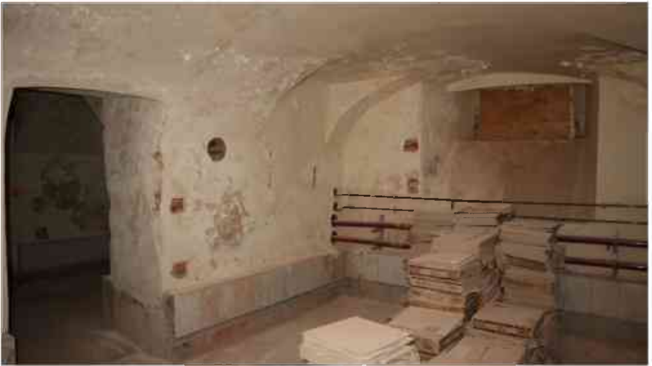
Фото п.150. Подвал, помещение 9Н (17).
