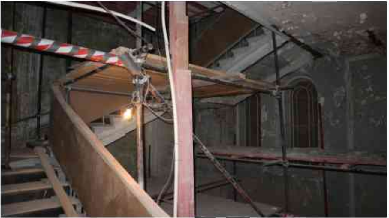
Фото 4.130. 4 этаж, лестница в ризалите южного фасада (западная часть).*
