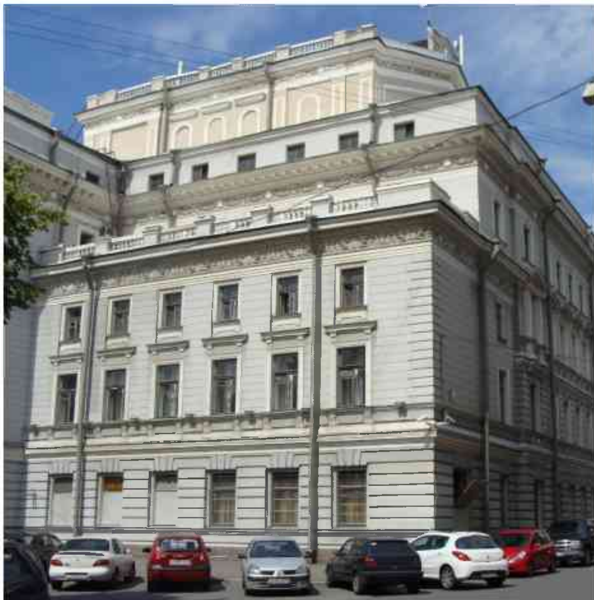
Ил. 217. Здание С.-Петербургской Консерватории им. Н. А. Римского-Корсакова. Восточная часть южного фасада. Фото 2012 года.
