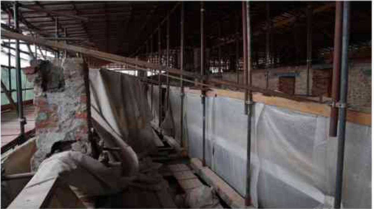
Фото 5.164. 5 этаж, чердачное помещение.
