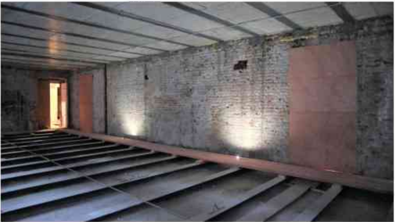
Фото 4.76. 4 этаж, помещение 33Н (16-20).
