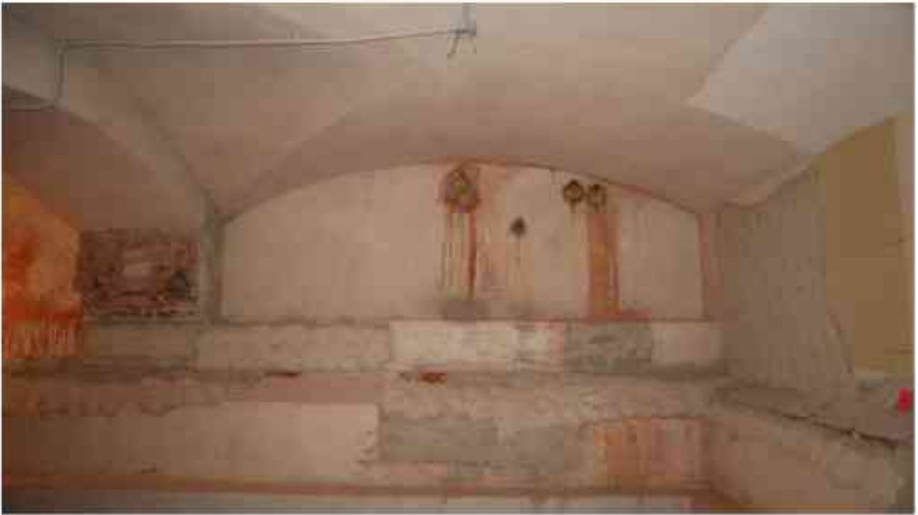
Фото п.269. Подвал, помещение 6Н (12).
