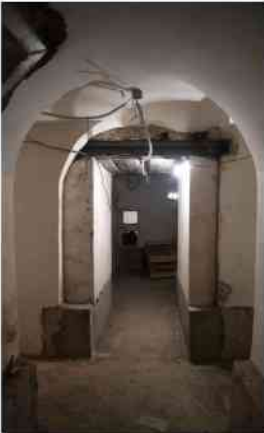
Фото п.100. Подвал, помещение 4Н (1).
