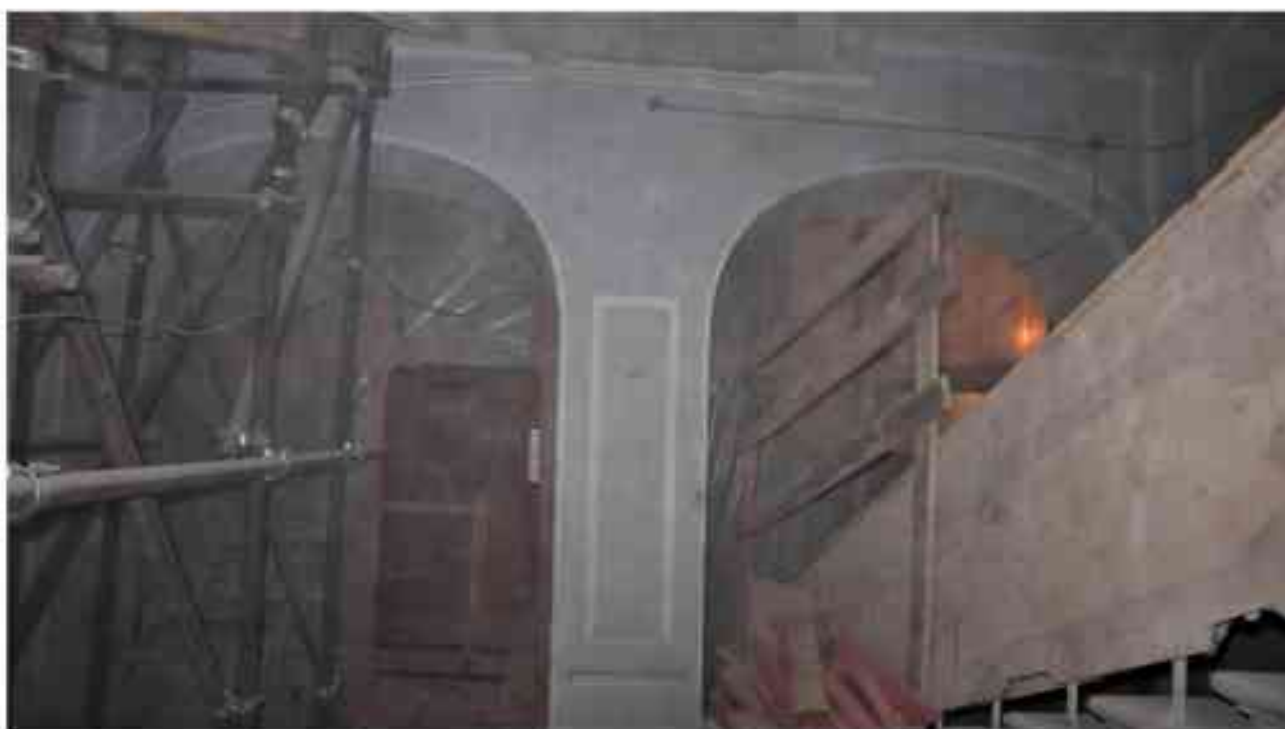
Фото 1.107. 1 этаж, лестница Л-16.
