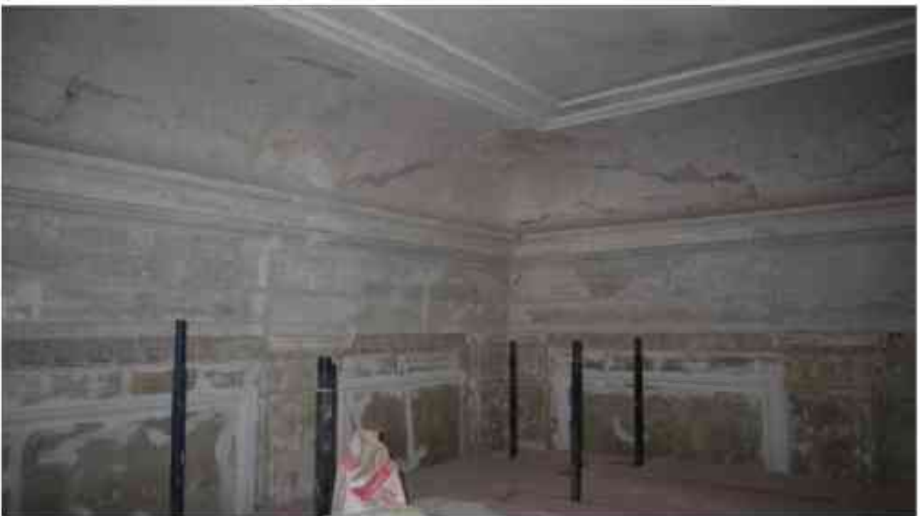
Фото 3.149. 3 этаж, помещение 25Н (11).*
