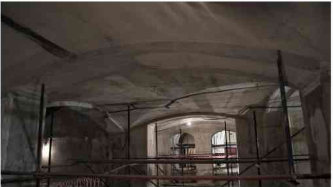
Фото 1.307. 1 этаж, помещение 13Н (4).
