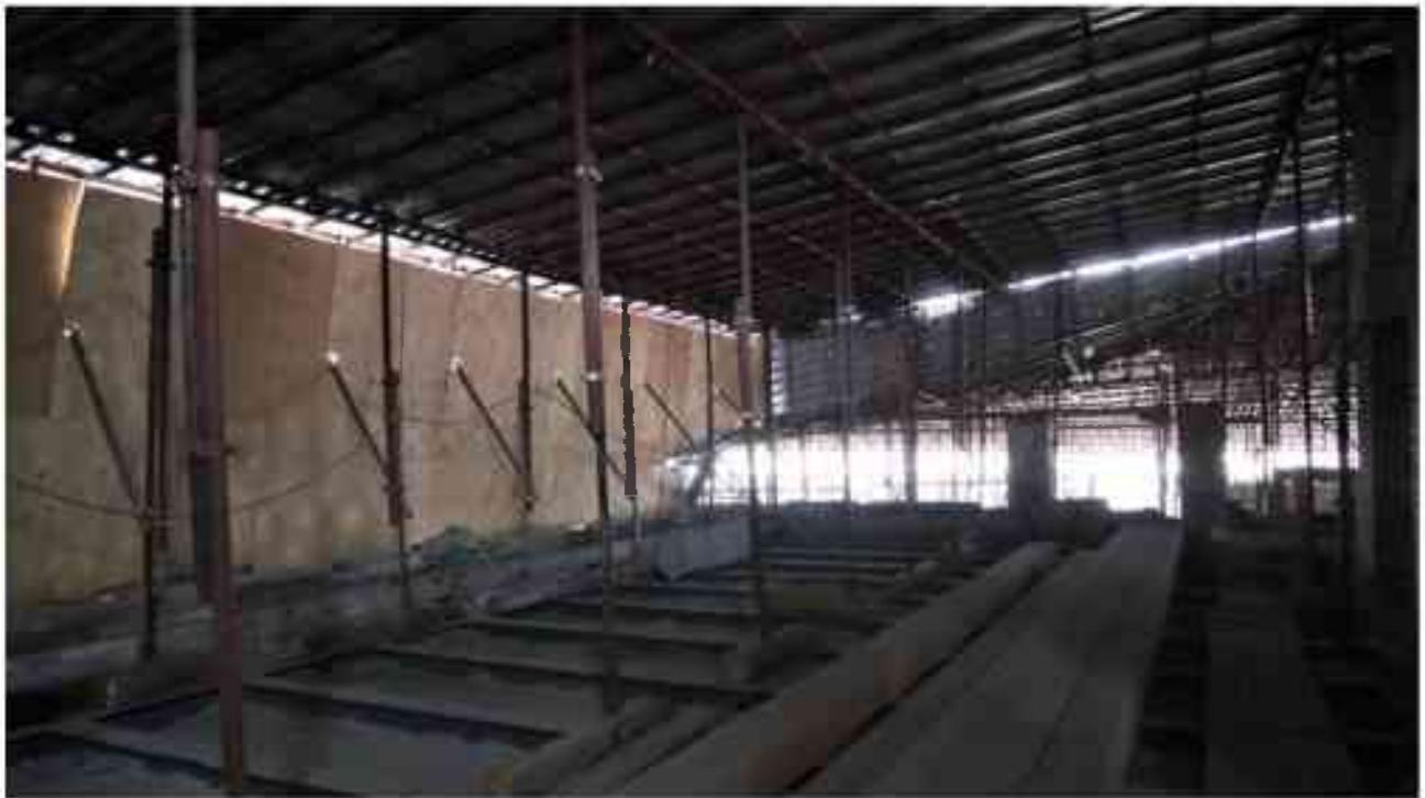
Фото 6.43. 6 этаж, чердачное помещение.
