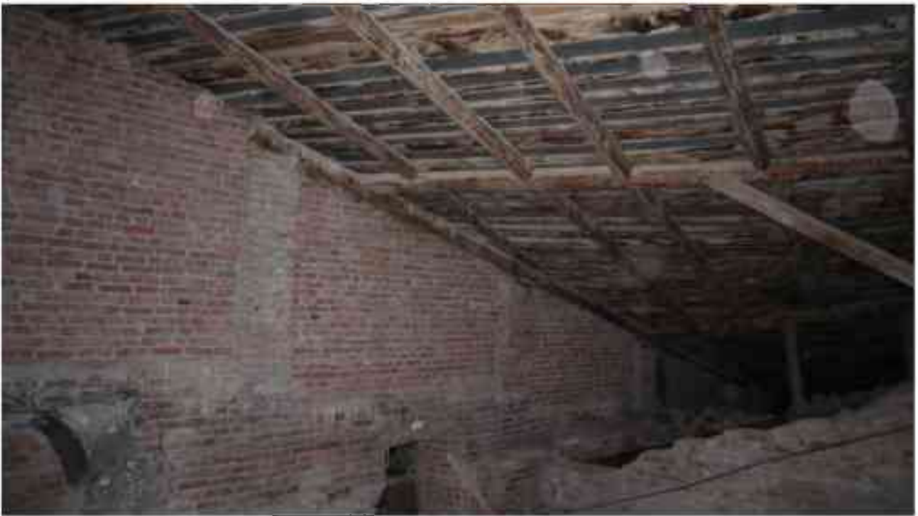
Фото 6.64. 6 этаж, чердачное помещение.
