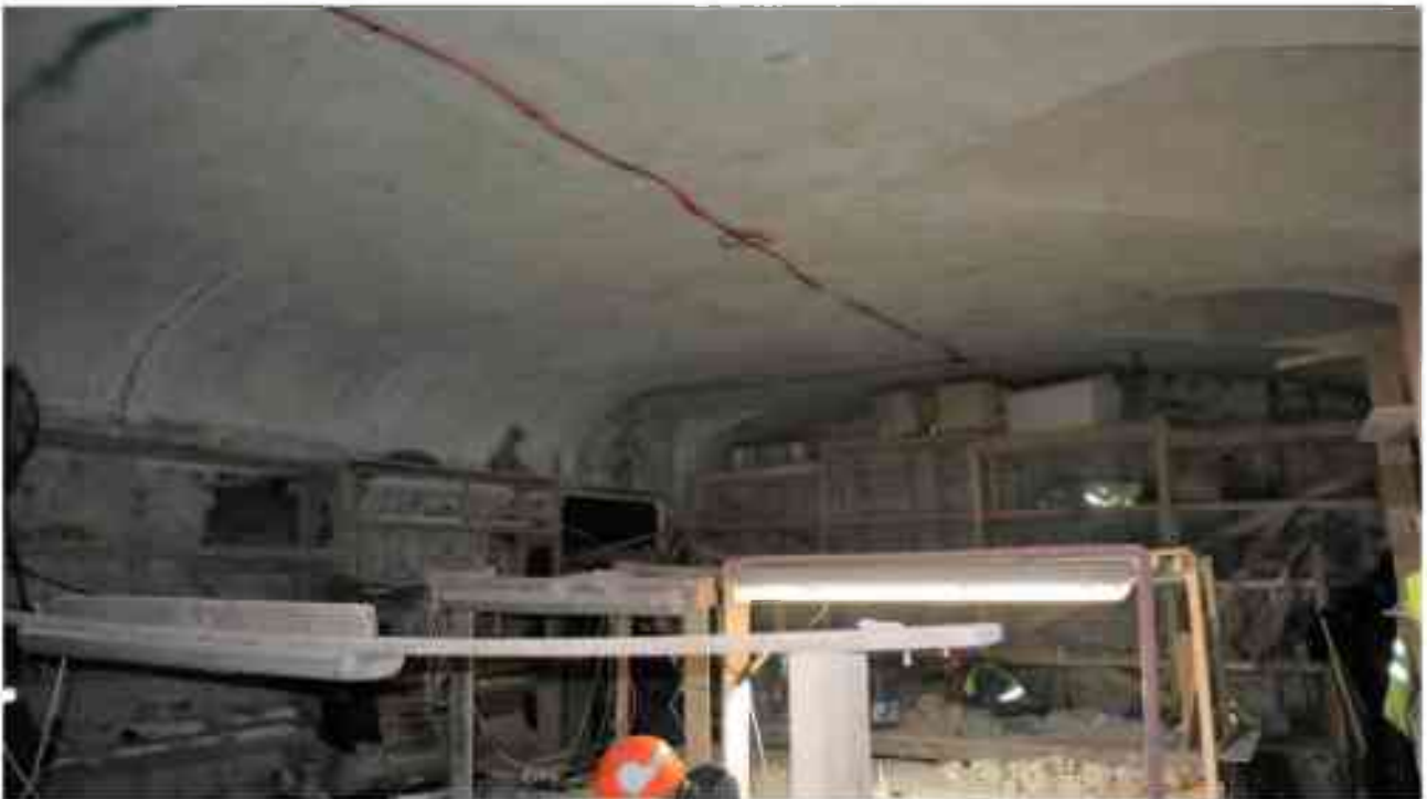
Фото 2.39. 2 этаж, помещение 22Н (52).
