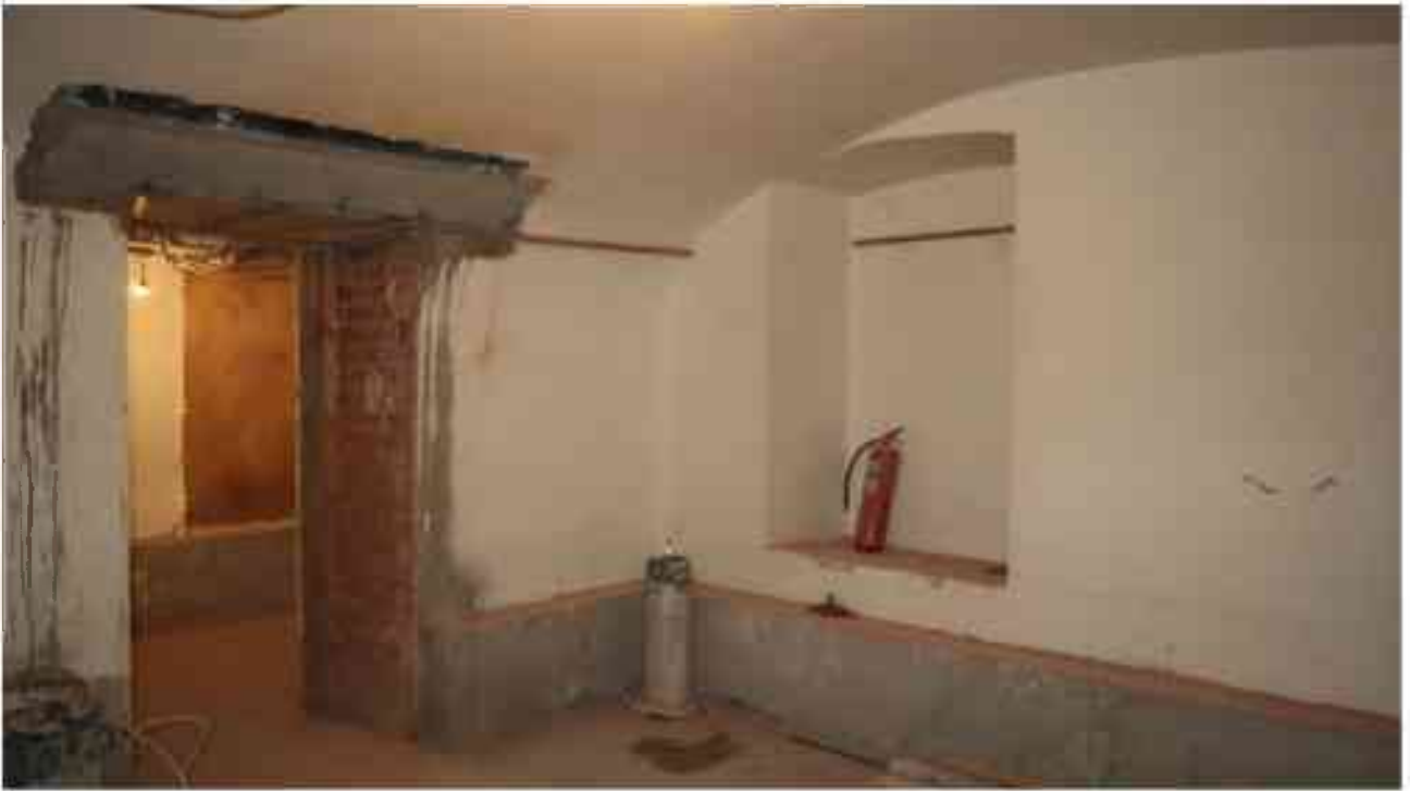
Фото п.164. Подвал, восточная часть помещения 9Н (13), разделенного перегородкой.
