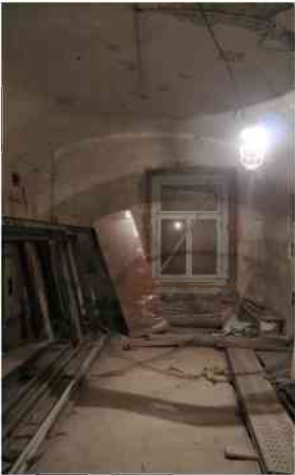
Фото 1.28. 1 этаж, помещение 14Н (17-18).
