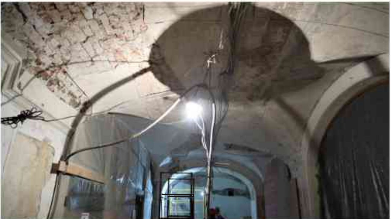
Фото 1.87. 1 этаж, помещение 14Н (29).
