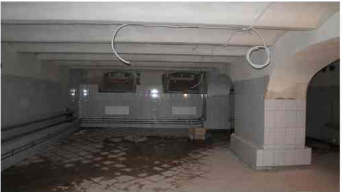
Фото п.279. Подвал, помещение 6Н (9).
