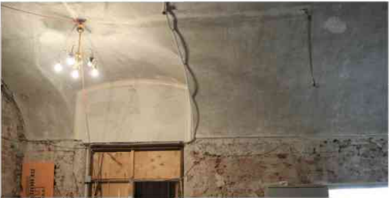
Фото 2.34. 2 этаж, помещение 22Н (49).
