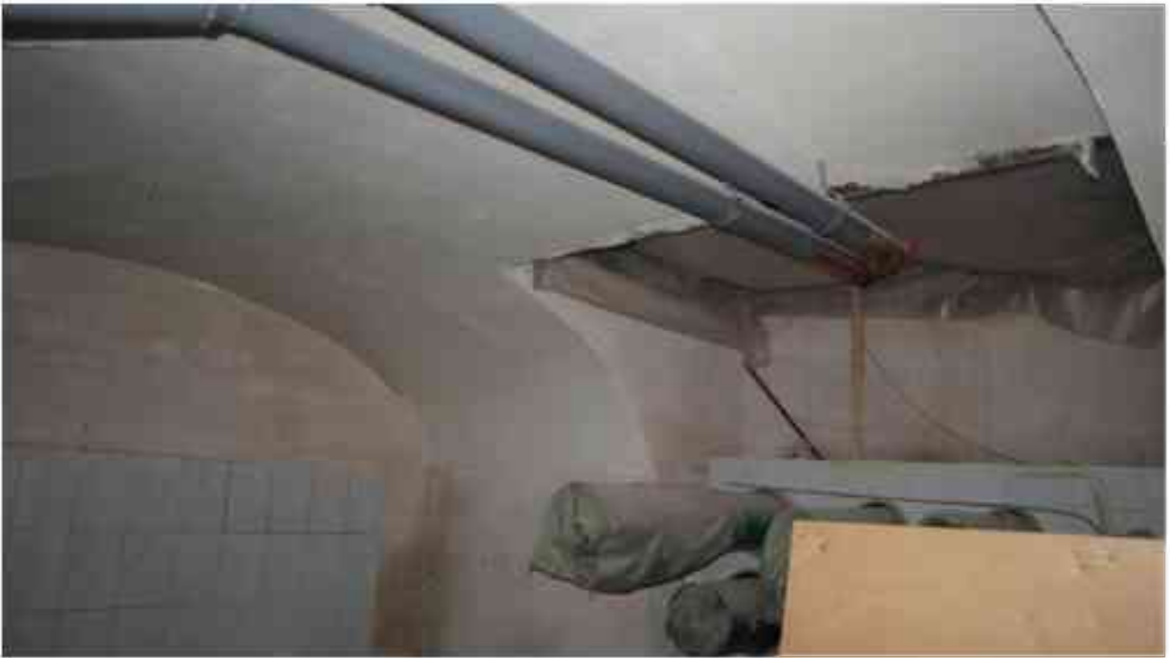
Фото п.179. Подвал, помещение 9Н (8).
