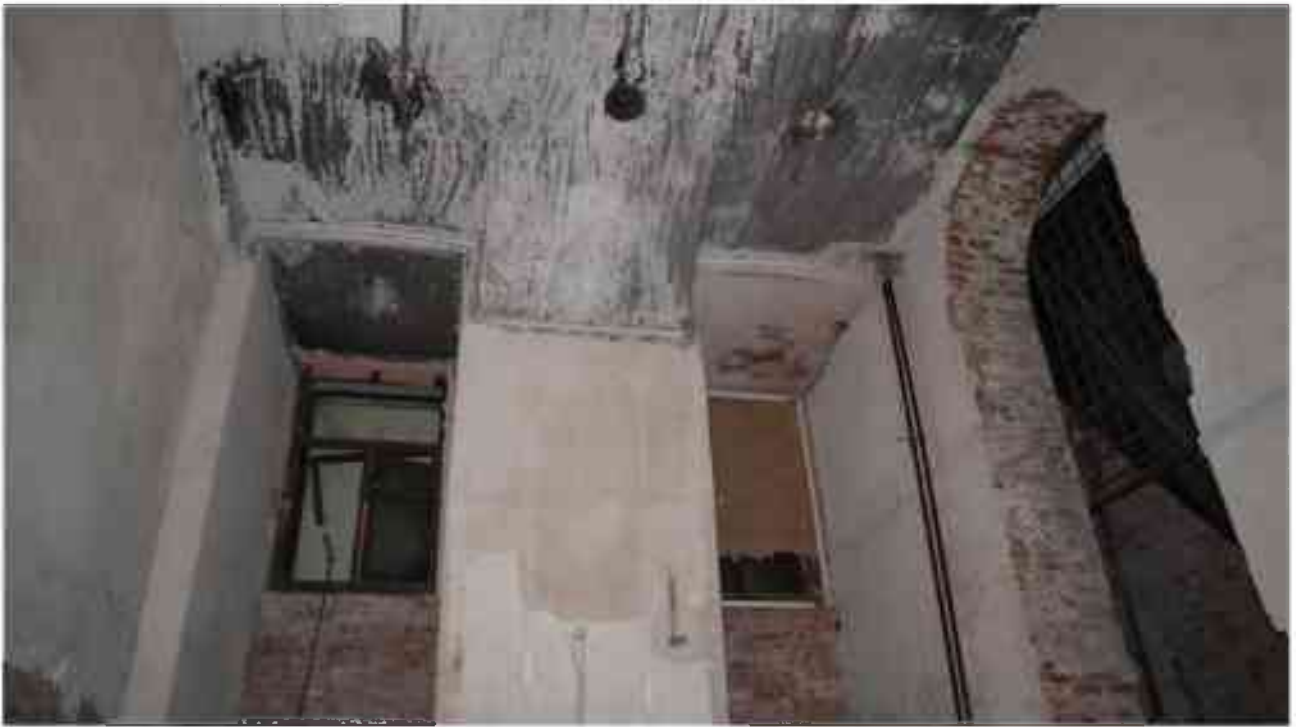
Фото п.61. Подвал, помещение 3Н (15).
