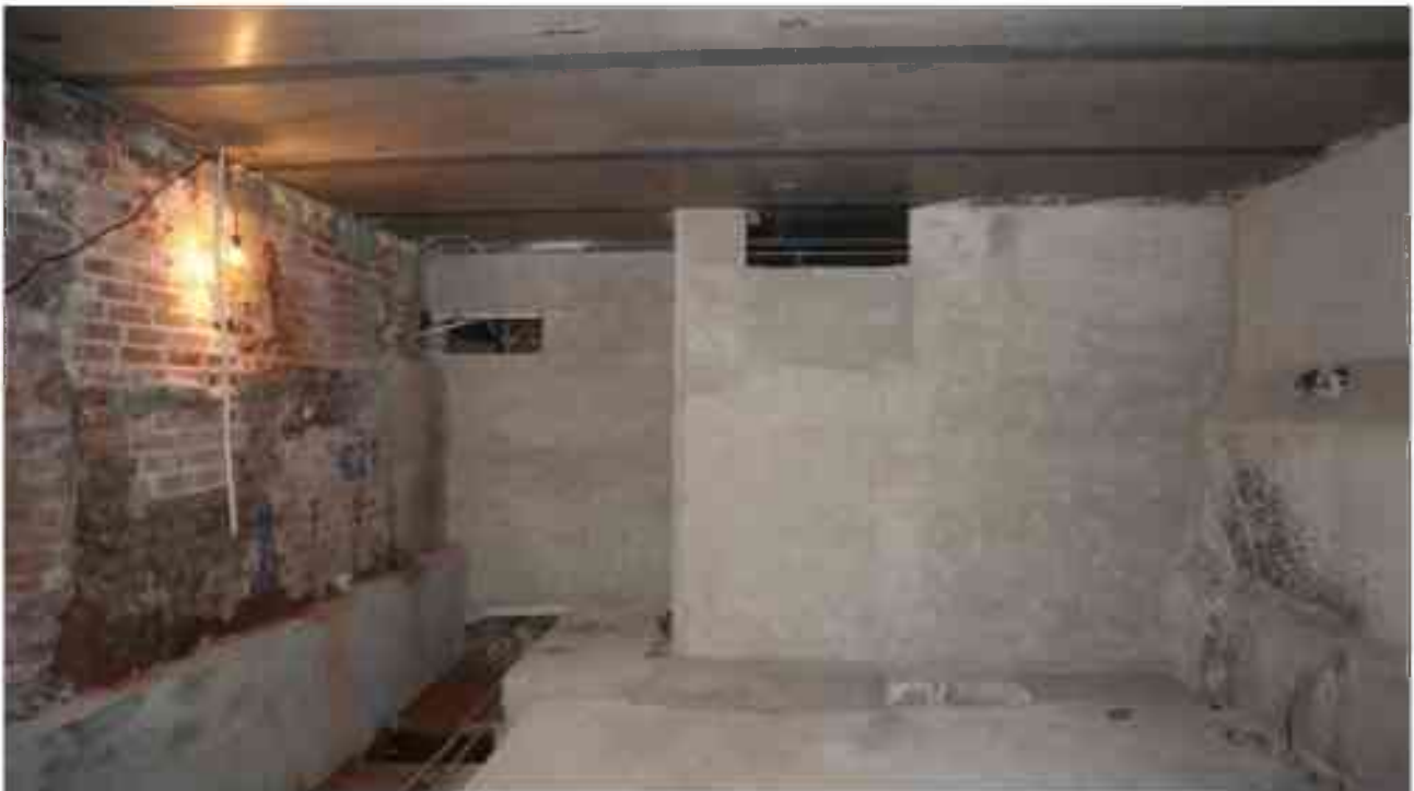
Фото п.230. Подвал, помещение 9Н (23, 24).
