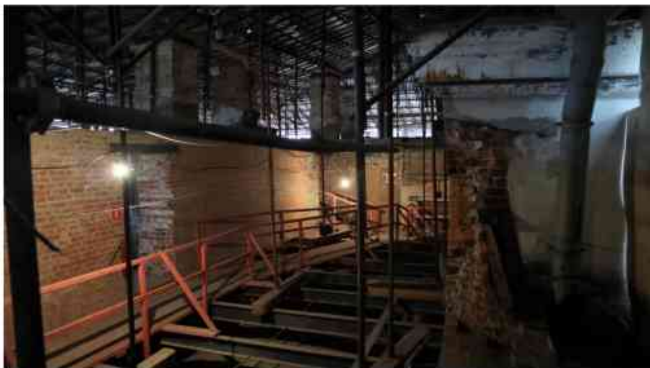
Фото 5.183. 5 этаж, коридор, помещения 34Н/37Н.
