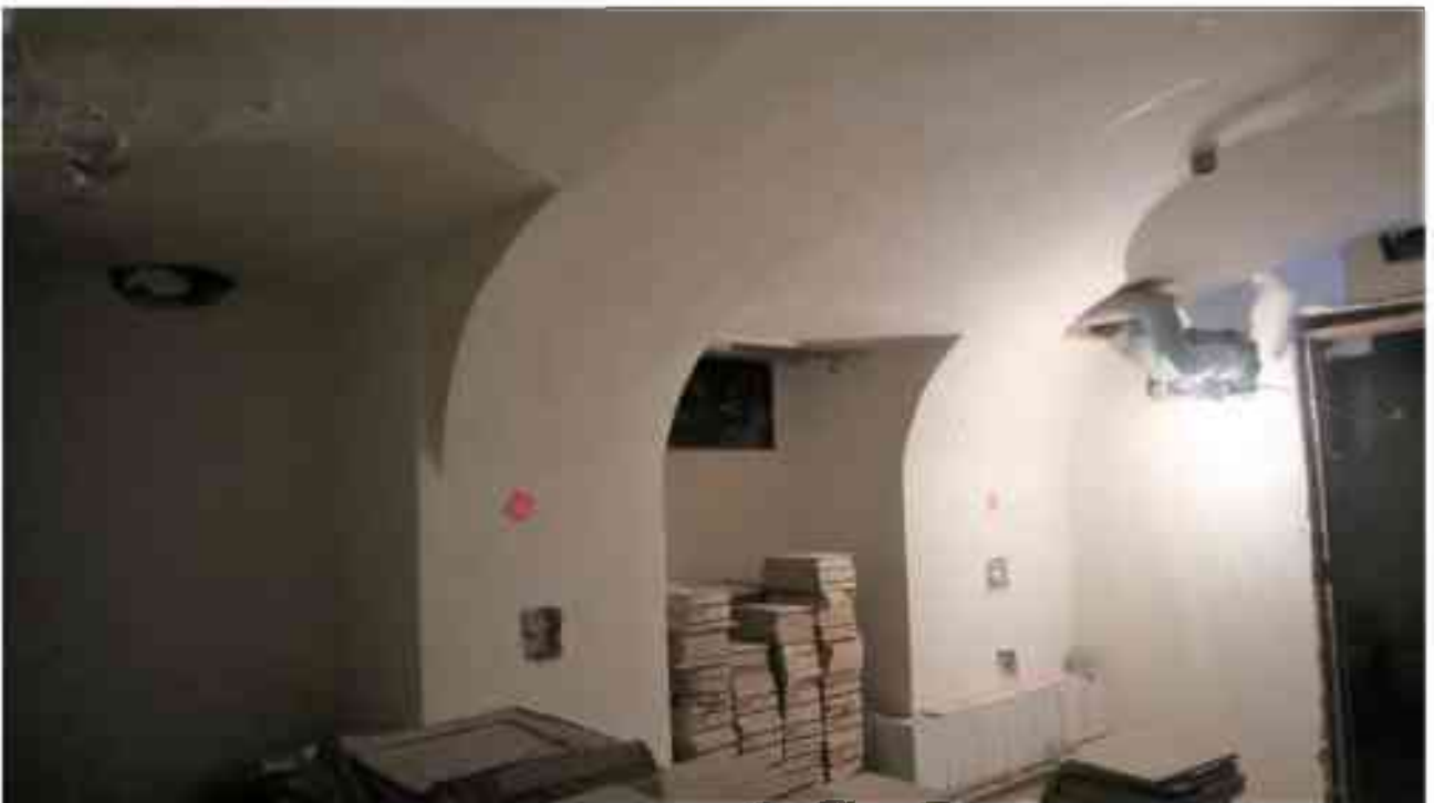
Фото п.151. Подвал, помещение 9Н (17).
