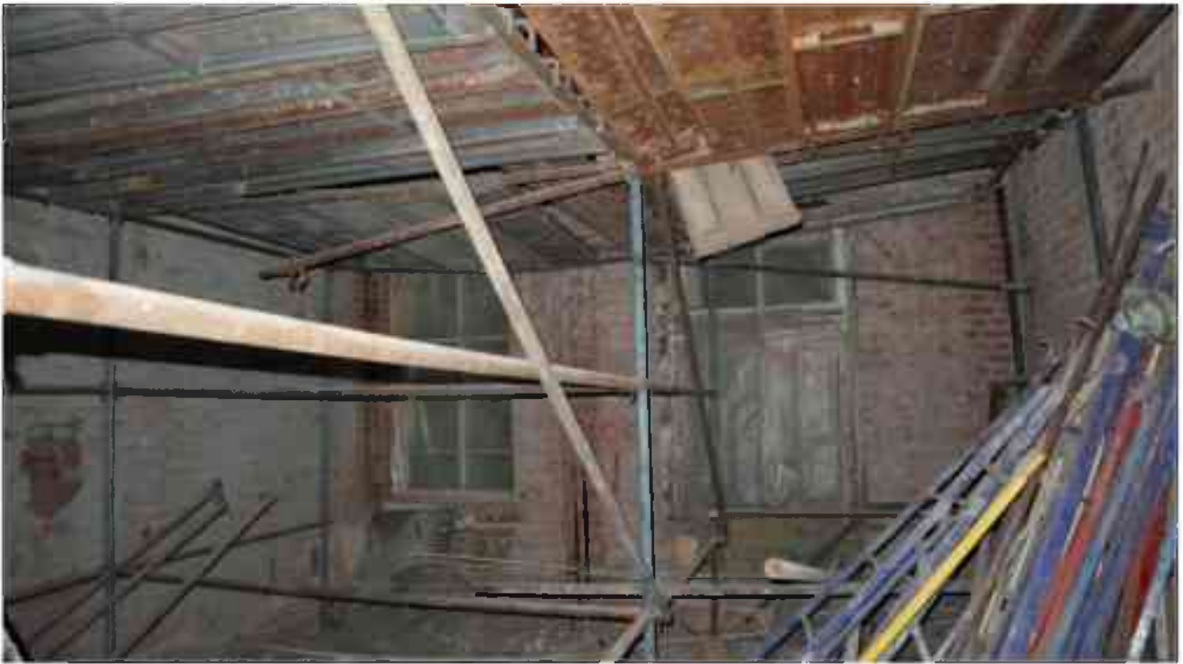
Фото 1.95. 1 этаж, помещение 14Н (43-44).
