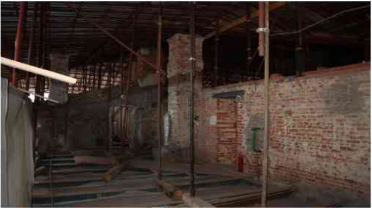
Фото 5.166. 5 этаж, чердачное помещение.
