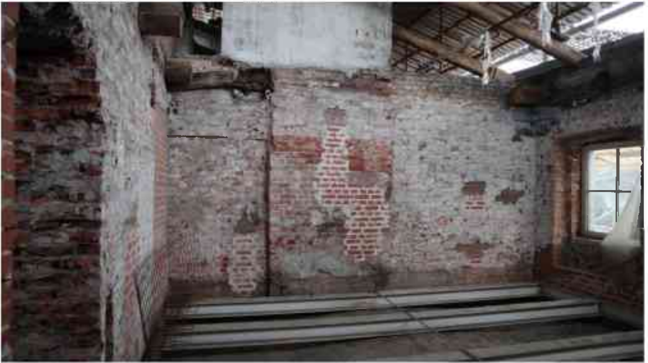
Фото 5.138. 5 этаж, жилой блок, на плане ПИБ 2000г. обозначен как квартиры, помещение (7-8).
