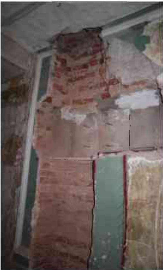
Фото 3.127. 3 этаж, лестница Л-13.
