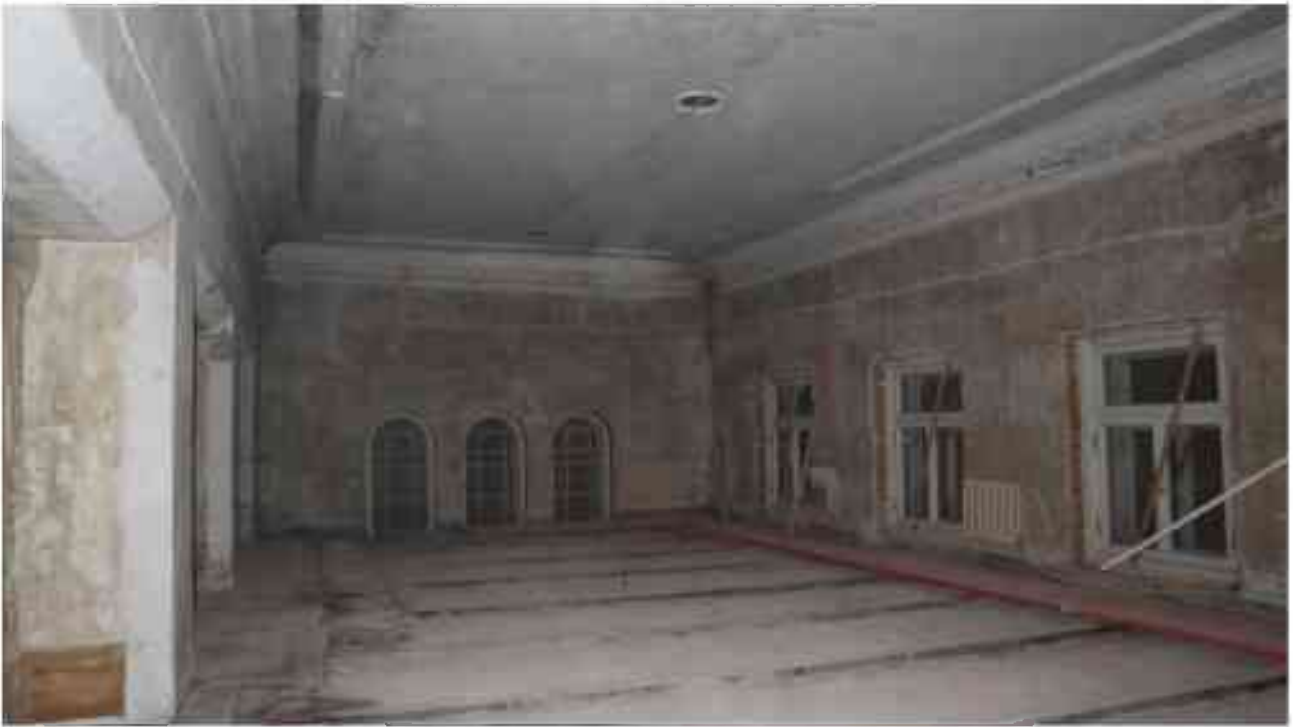
Фото 4.10. 4 этаж, помещение 33Н (38).
