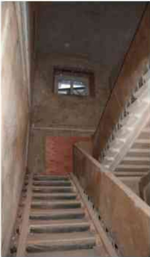
Фото 4.79. 4 этаж, лестница Л-1.
