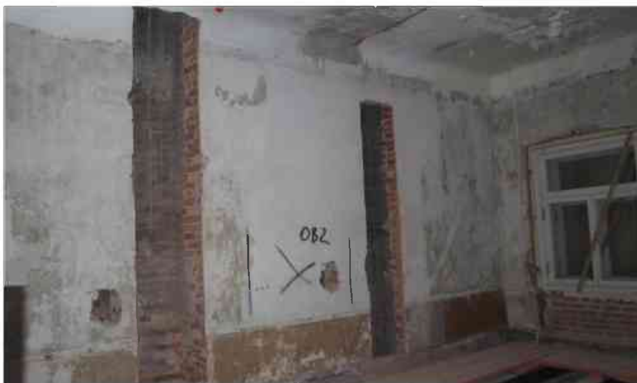
Фото 4.35. 4 этаж, помещение 33Н (40, 41).
