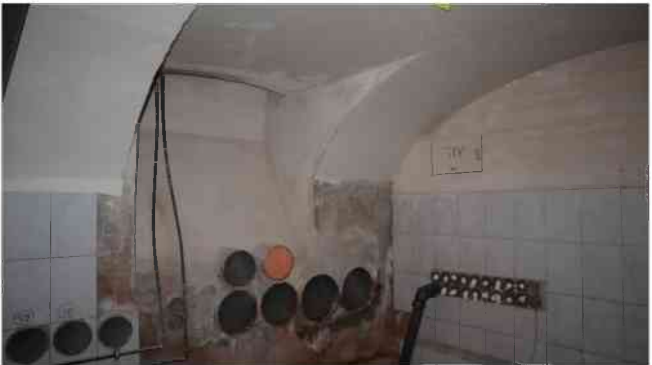
Фото п.178. Подвал, помещение 9Н (8).
