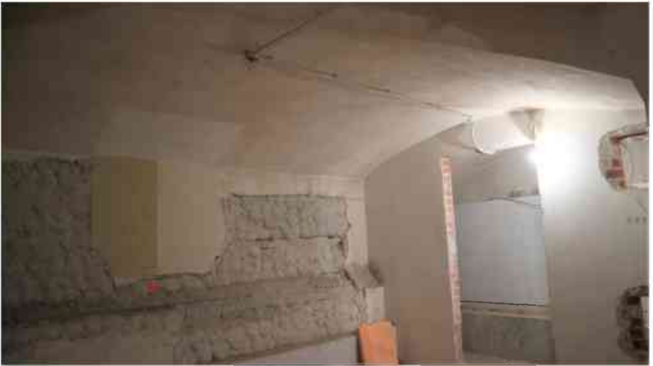
Фото п.274. Подвал, помещение 6Н (12).
