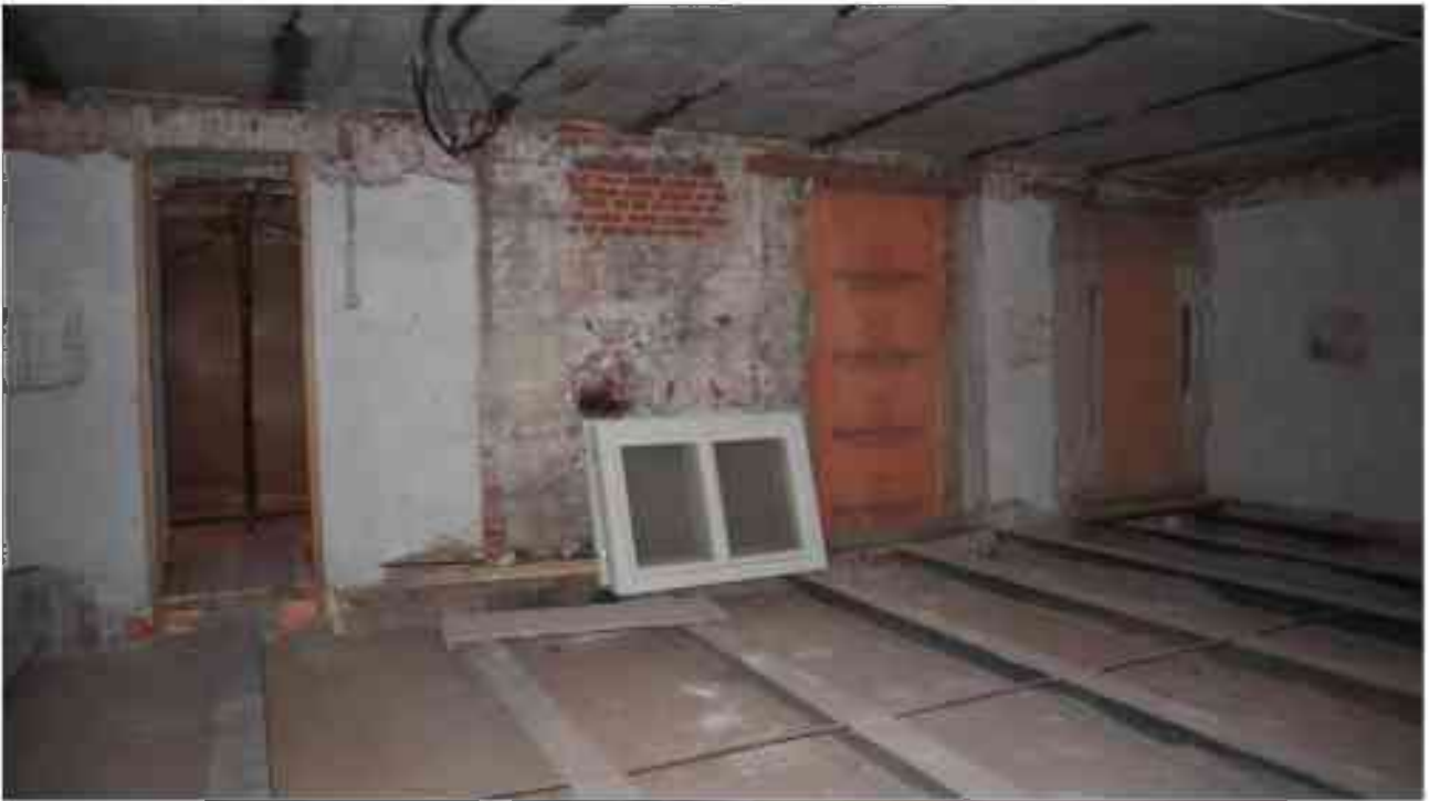
Фото 5.22. 5 этаж, помещение 37Н (6-8).
