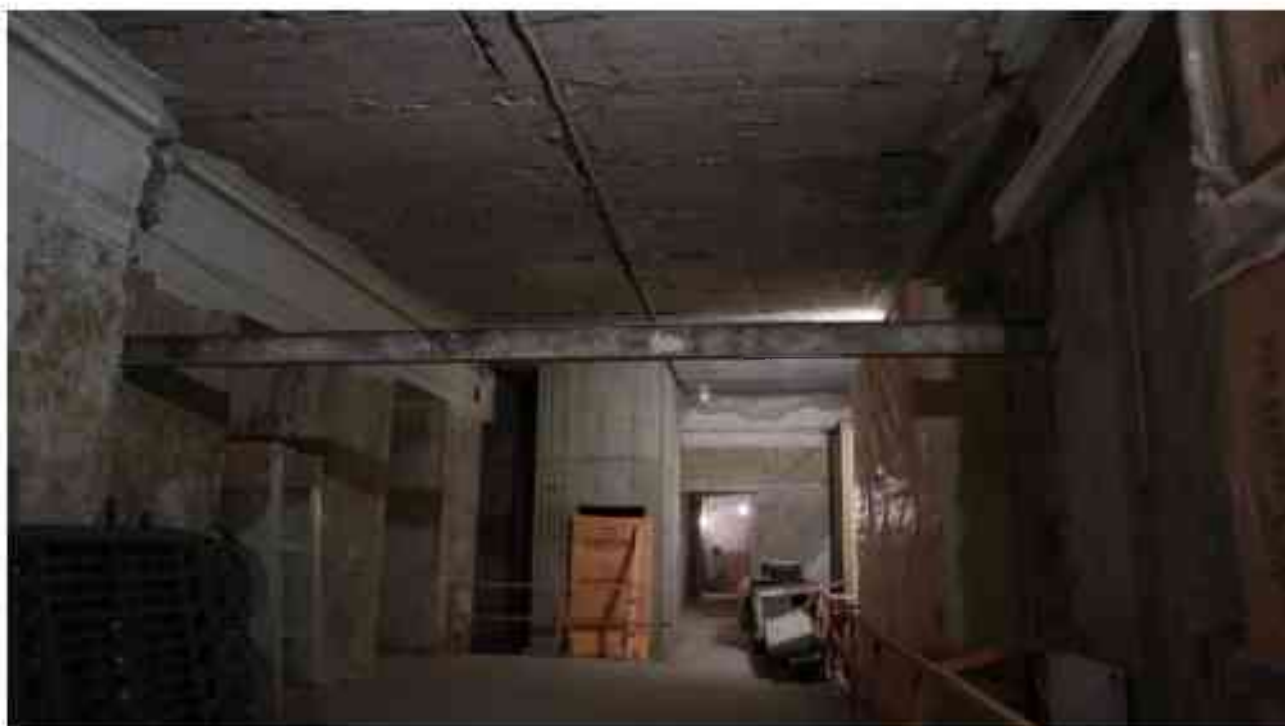
Фото 1.246. 1 этаж, помещение 13Н (5-6).
