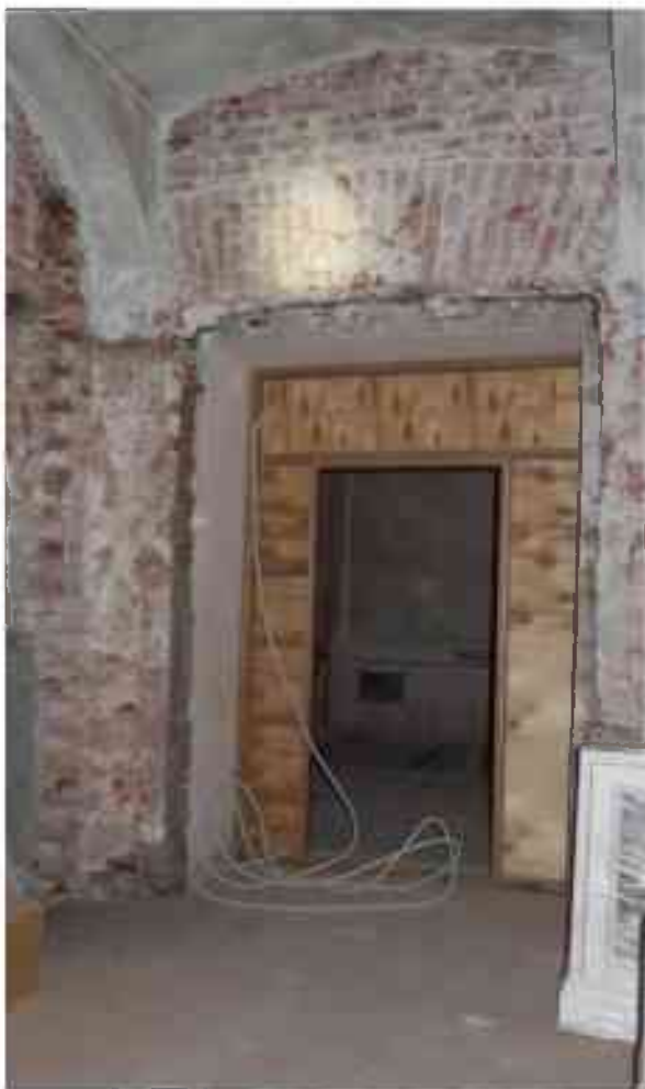
Фото 2.109. 2 этаж, помещение 22Н (44).
