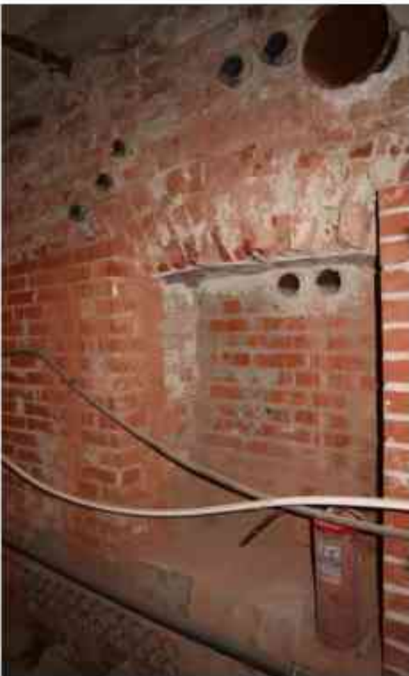
Фото п.18. Подвал, помещение 3Н (9).
