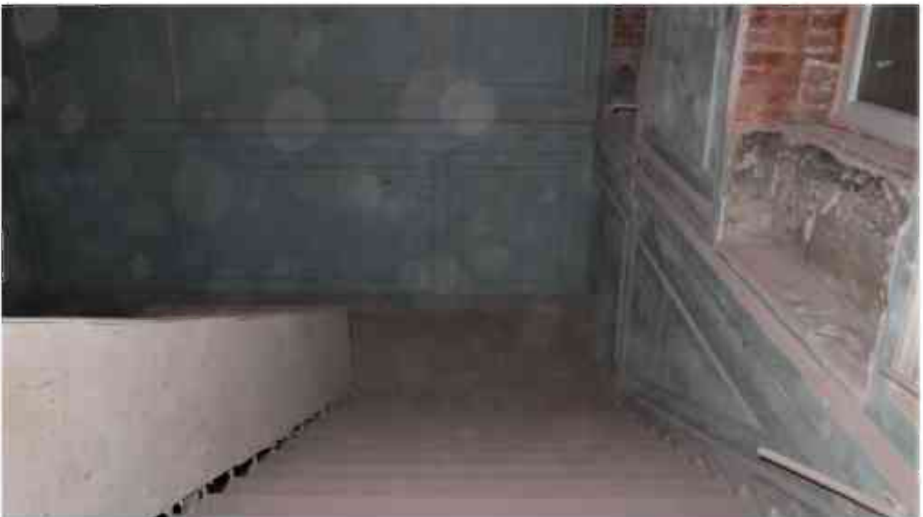
Фото 4.44. 4 этаж, лестница Л-16.
