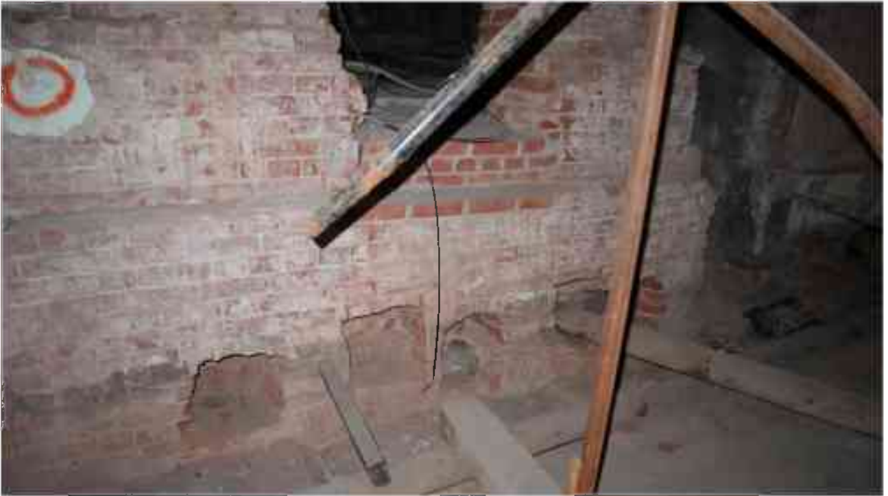
Фото 5.122. 5 этаж, коридор, помещения 34Н/37Н.
