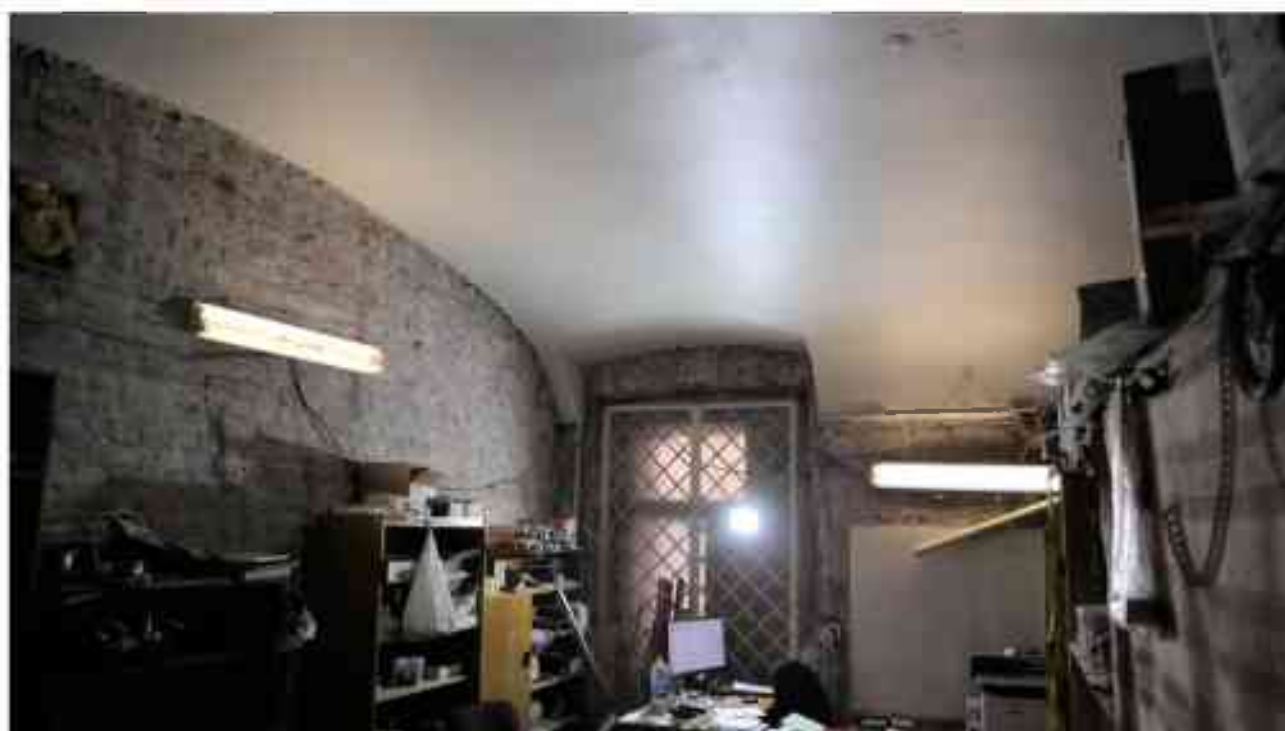
Фото 1.35. 1 этаж, помещение 14Н (8-9).
