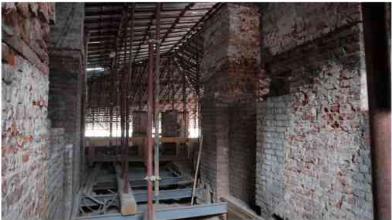
Фото 6.35. 6 этаж, чердачное помещение.
