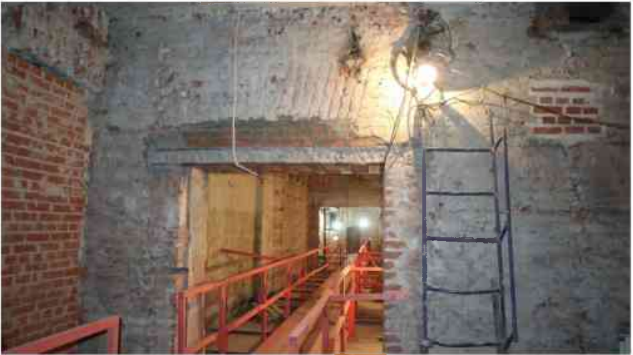
Фото 1.229. 1 этаж, помещение 15Н (4).
