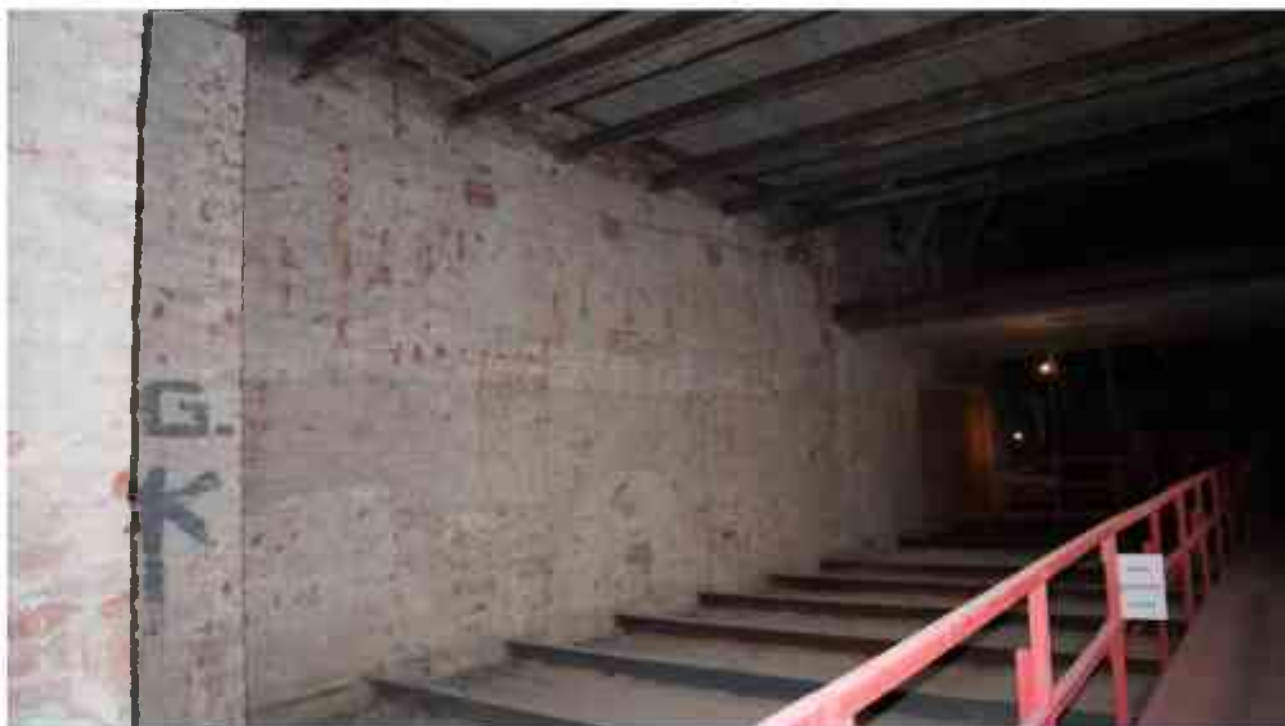
Фото 5.65. 5 этаж, помещение 35Н (4-6).
