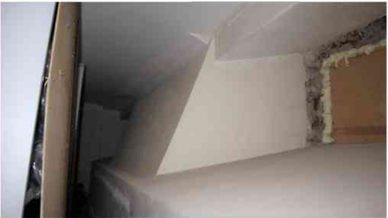
Фото п.121. Подвал, помещение 4Н (8-9).
