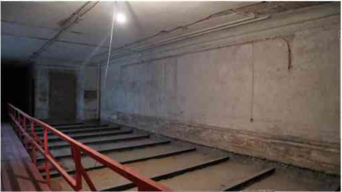
Фото 4.165. 4 этаж, помещение 30Н (7).
