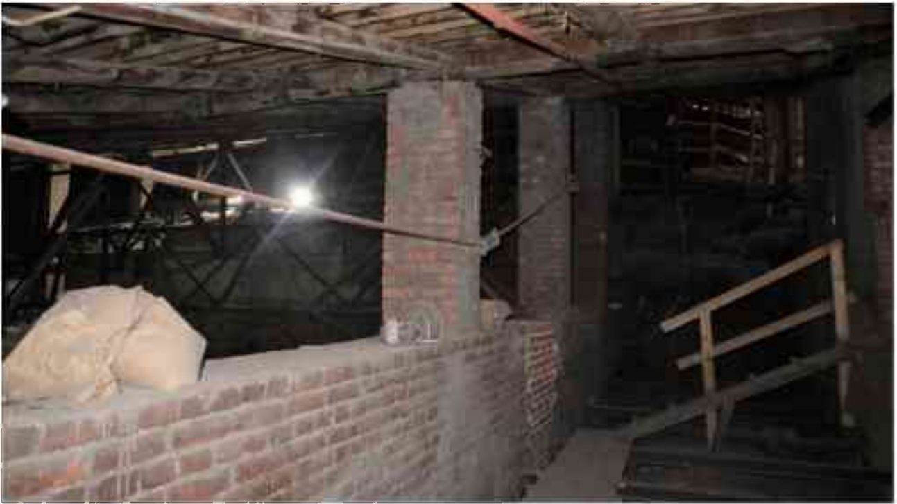
Фото 5.82. 5 этаж, чердачное помещение, купол.
