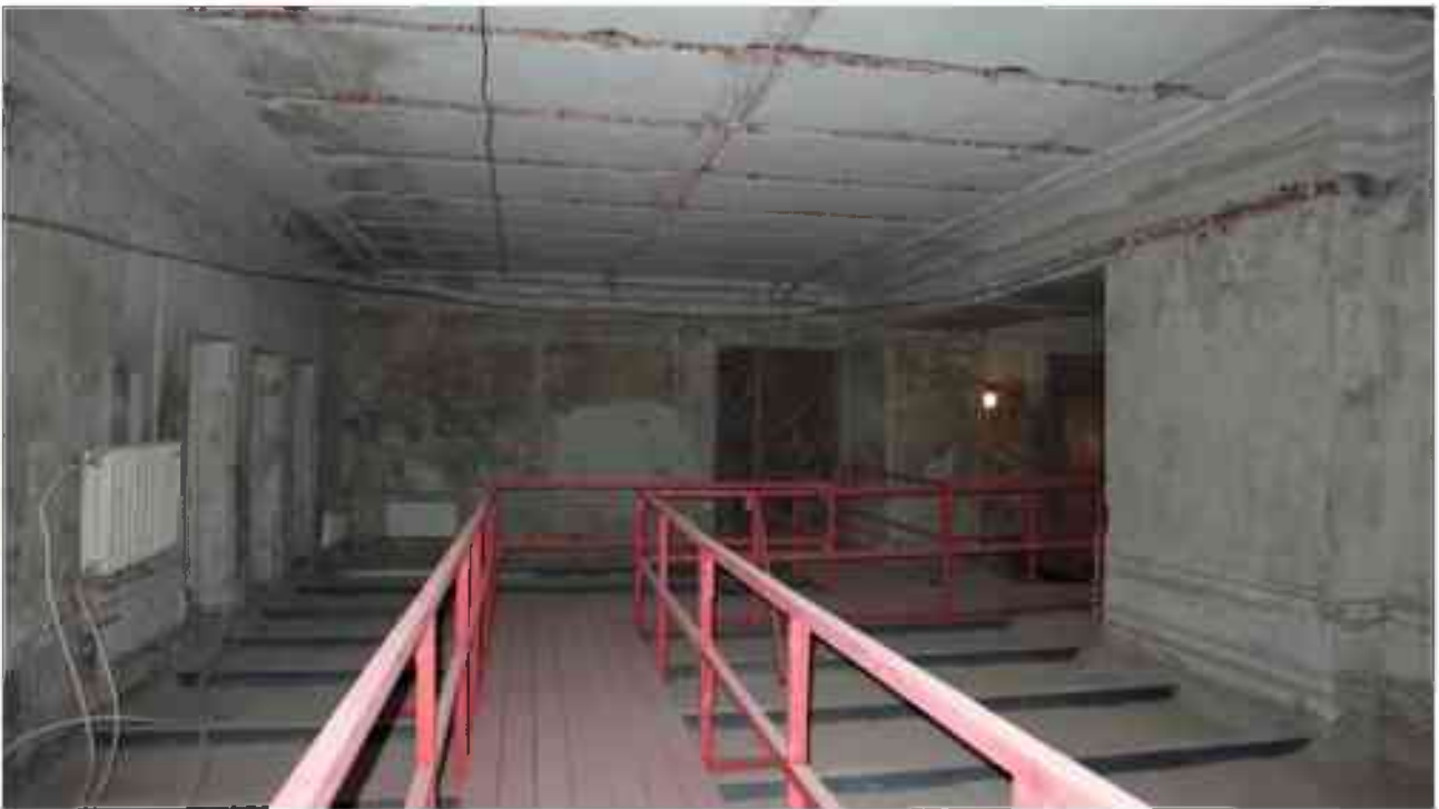
Фото 4.137. 4 этаж, помещение 30Н (1).
