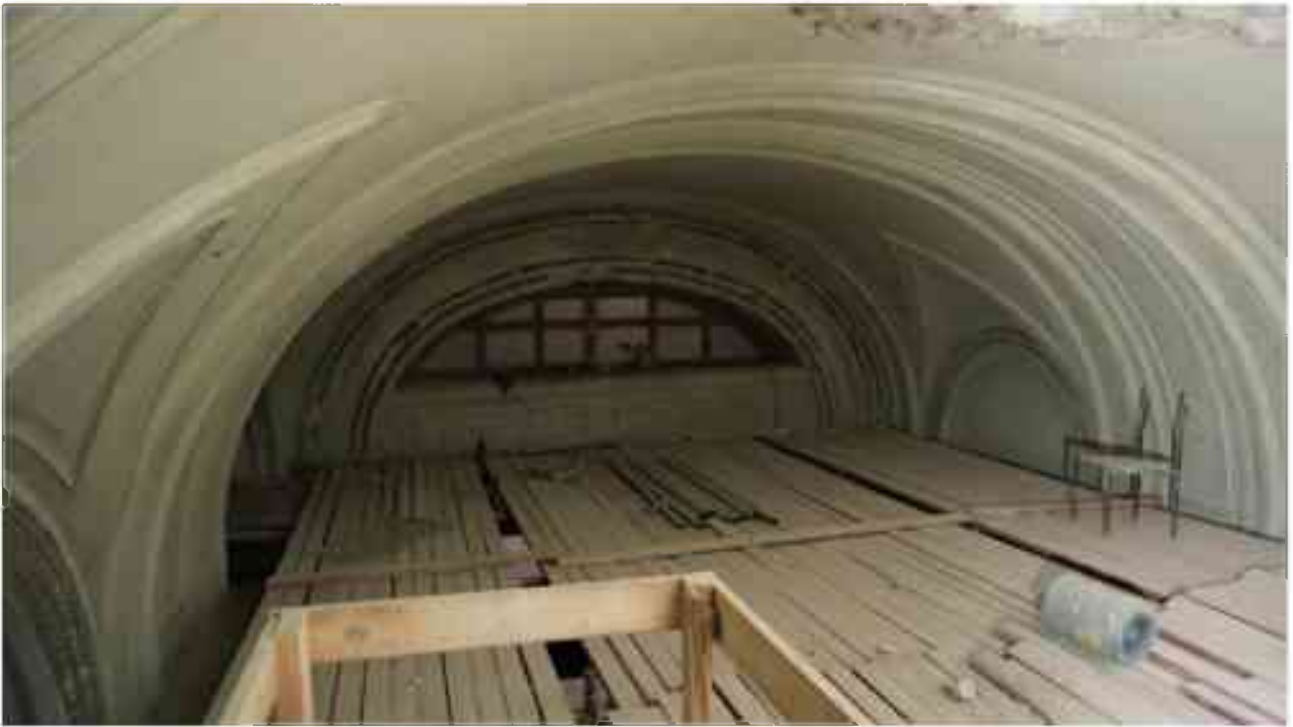
Фото 2.149. 2 этаж, помещение 22Н (19).*
