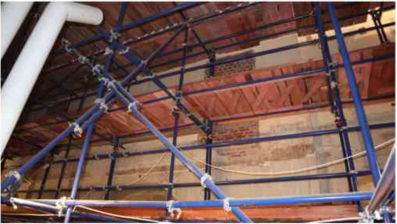
Фото 3.44. 3 этаж, помещение 28Н (20-21).
