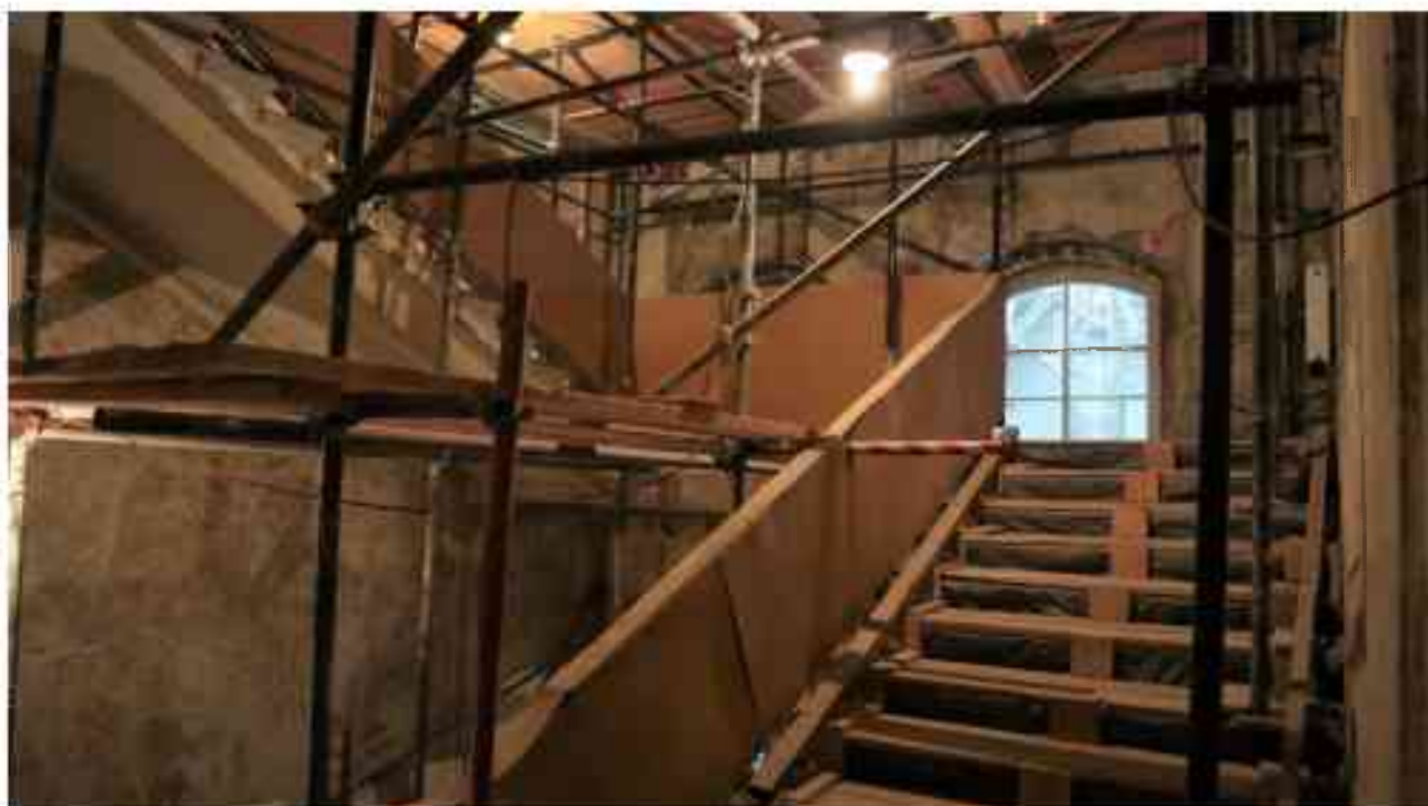
Фото 4.176. 4 этаж, лестница Л-13.
