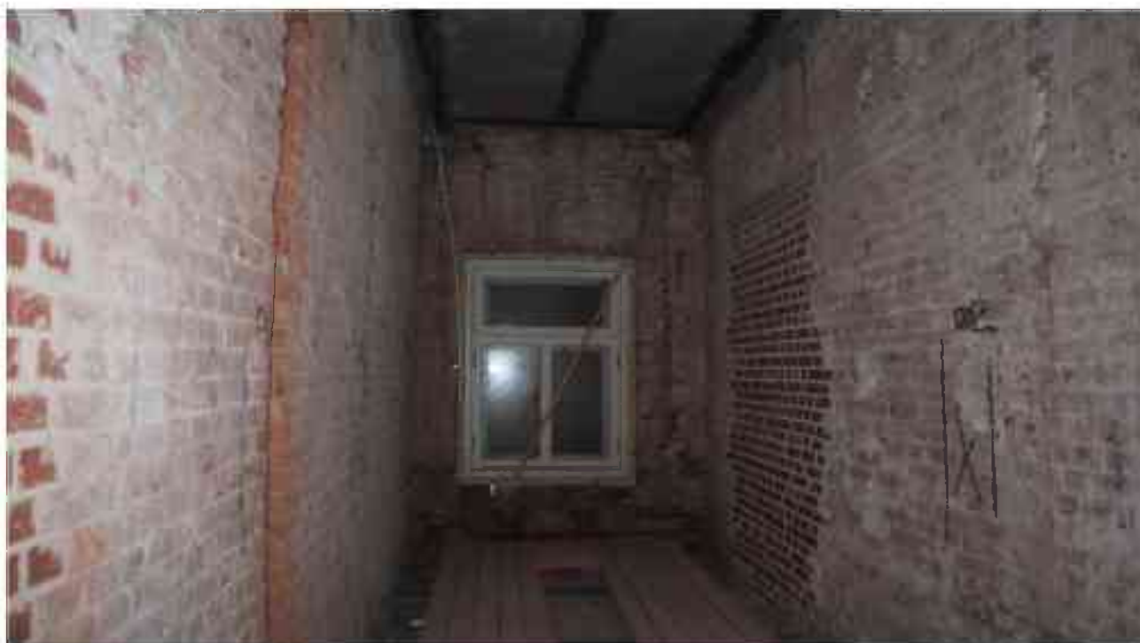
Фото 4.65. 4 этаж, помещение 33Н (50).
