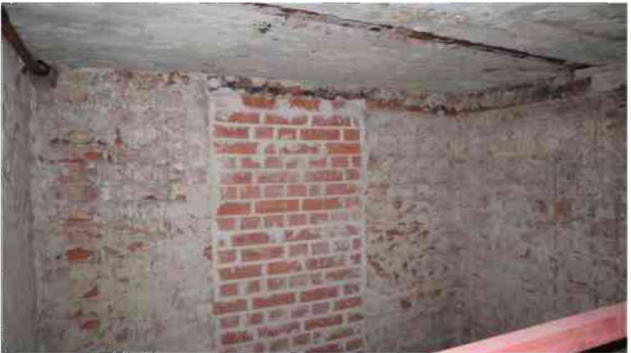
Фото п.343. Подвал, помещение 18Н (9).
