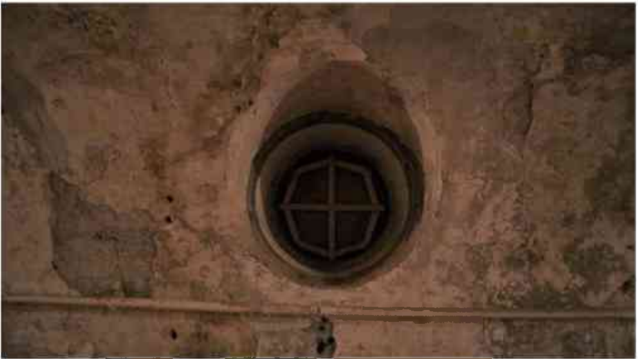
Фото 5.100. 5 этаж, помещение 35Н(2).
