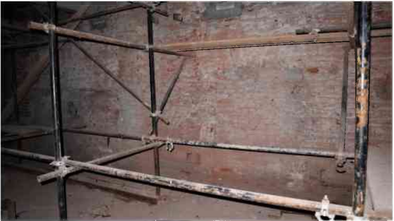
Фото 1.193. 1 этаж, помещение 17Н (3).
