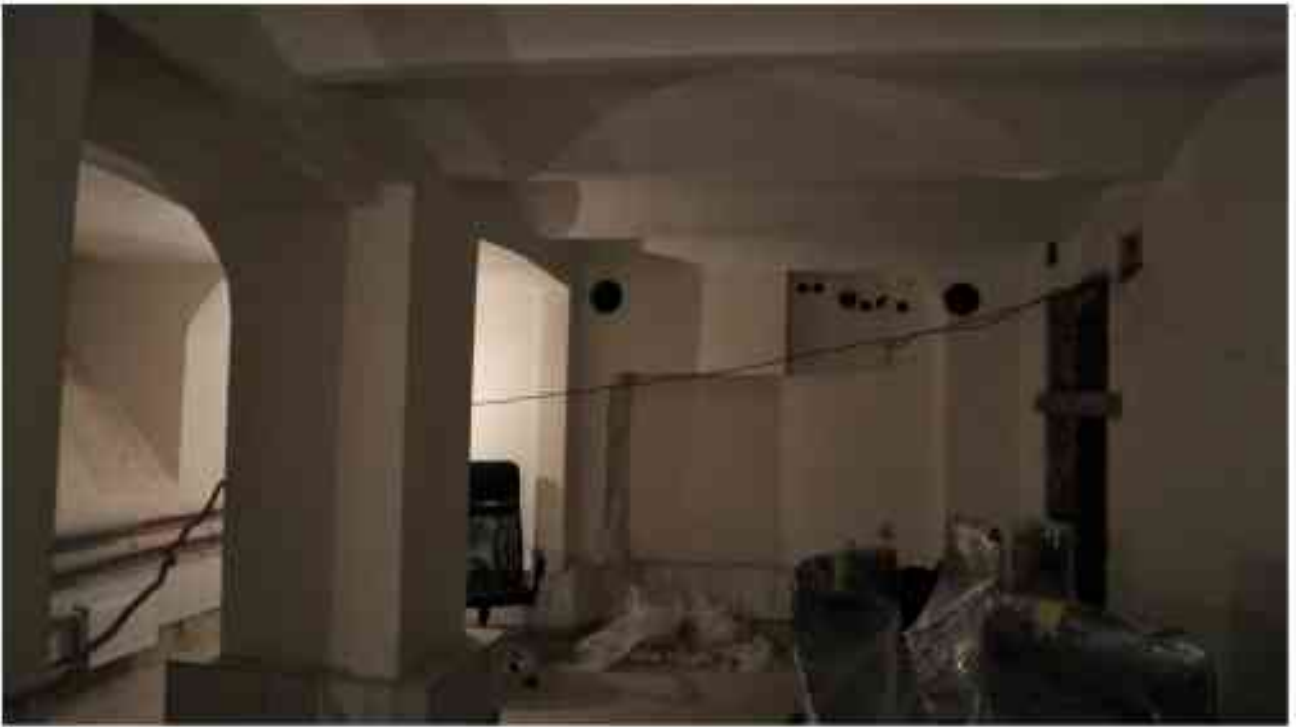
Фото п.139. Подвал, помещение 9Н (26).
