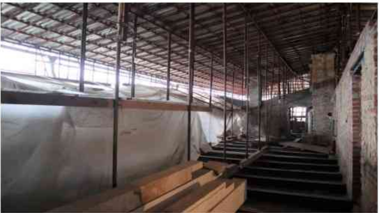
Фото 5.161. 5 этаж, чердачное помещение.
