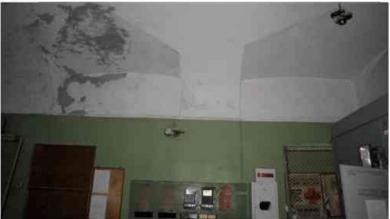
Фото 2.243. 2 этаж, помещение 22Н (57).
