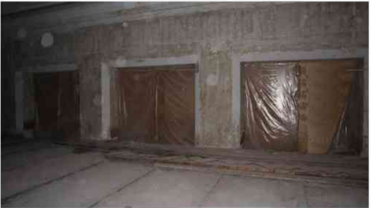
Фото 4.15. 4 этаж, помещение 33Н (38).
