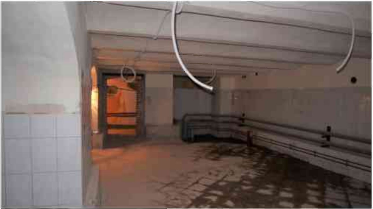
Фото п.280. Подвал, помещение 6Н (9).
