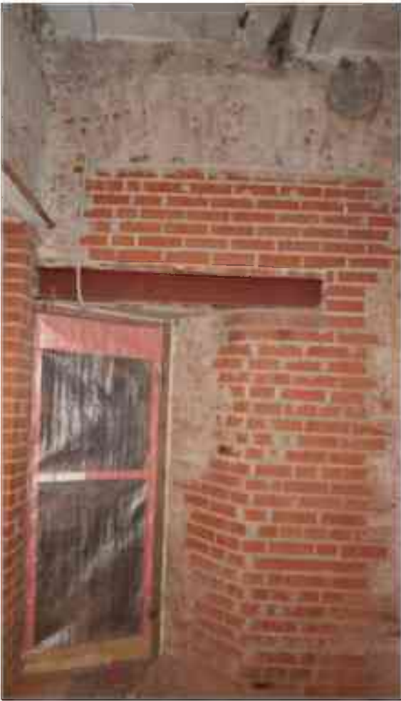
Фото 1.238. 1 этаж, помещение 17Н (7-8).
