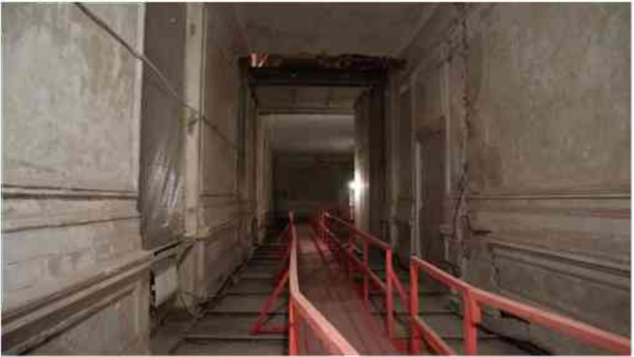
Фото 2.174. 2 этаж, помещение 22Н (17).
