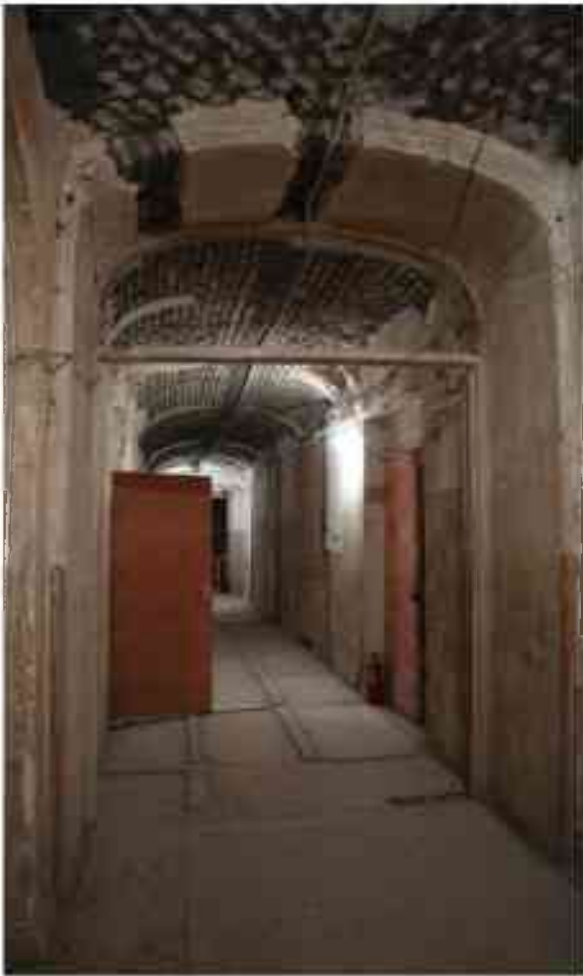
Фото 2.57. 2 этаж, помещение 22Н (36).
