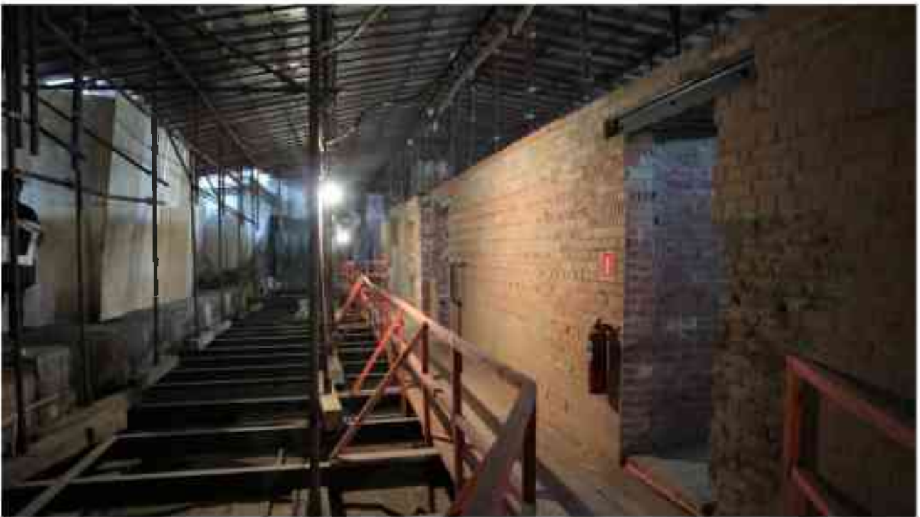
Фото 5.181. 5 этаж, коридор, помещения 34Н/37Н.
