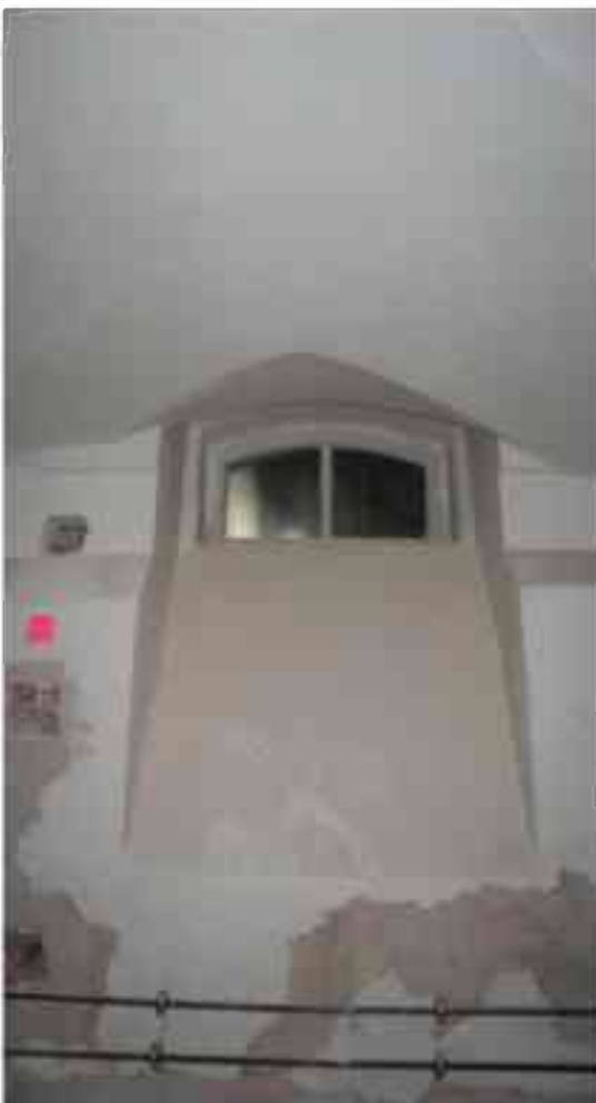
Фото п.209. Подвал, помещение 9Н (7).
