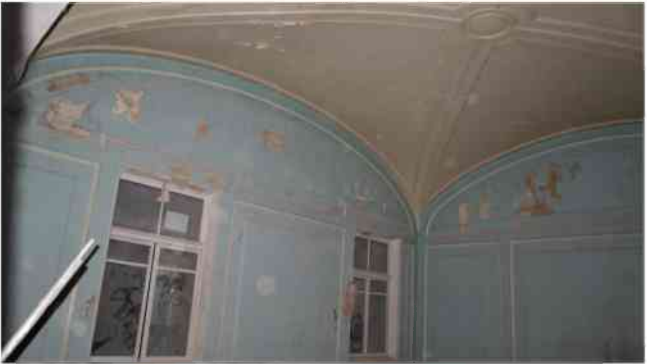
Фото 4.45. 4 этаж, лестница Л-16.
