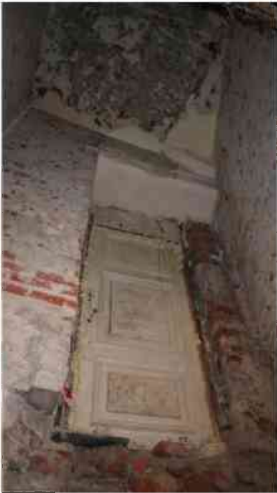
Фото п.287. Подвал, помещение 3Н (17).
