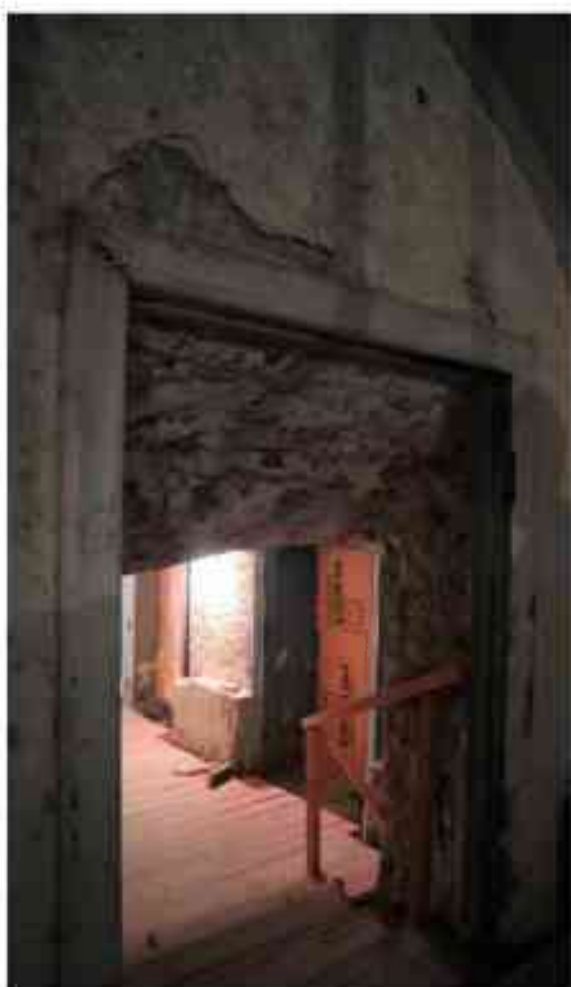
Фото 1.157. 1 этаж, помещение 10Н (1).
