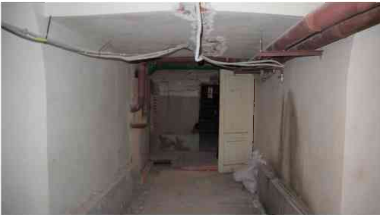
Фото п.176. Подвал, помещение 9Н (8).
