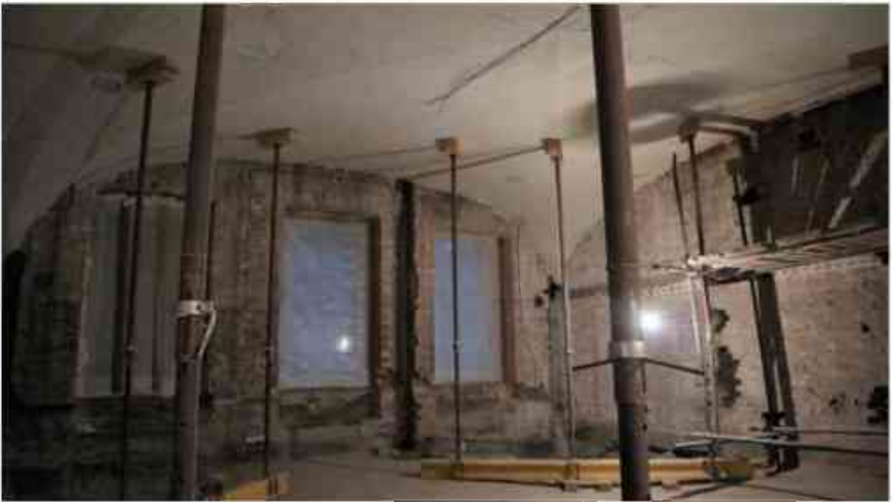
Фото 2.59. 2 этаж, помещение 22Н (37, 87-89).
