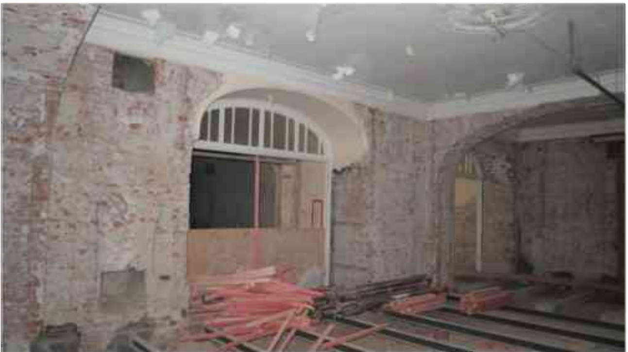
Фото 2.24. 2 этаж, помещение 22Н (48).
