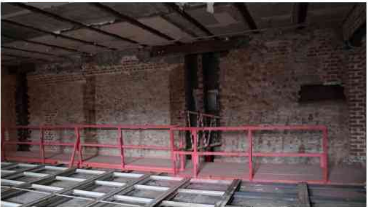
Фото 5.54. 5 этаж, помещение 35Н (12-17).
