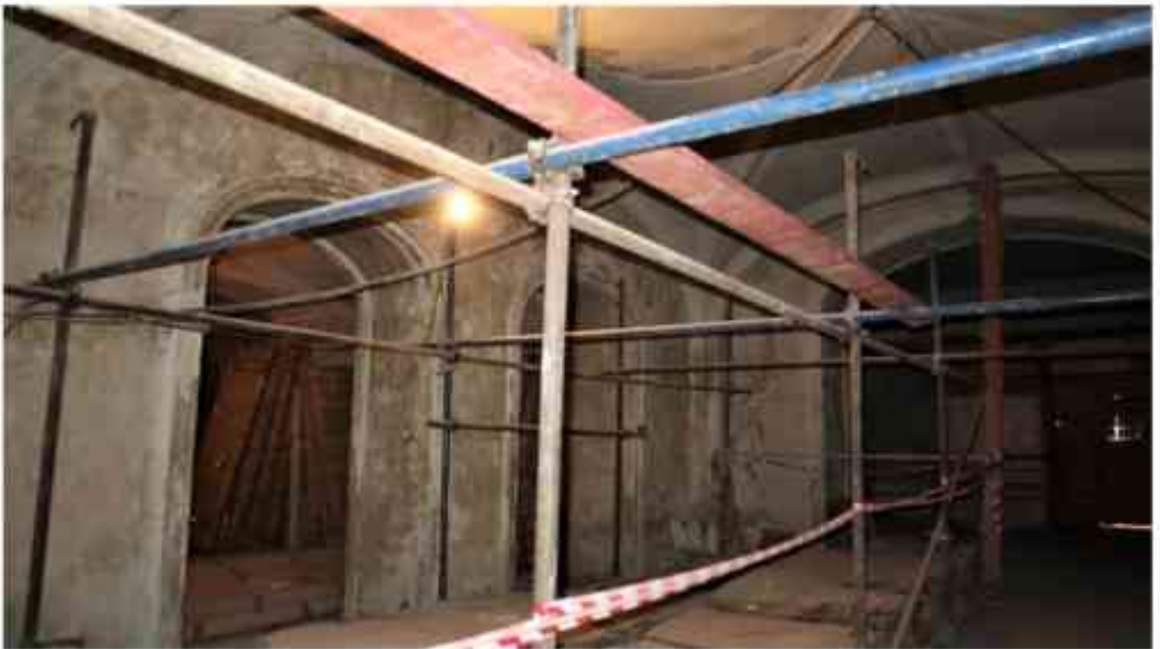
Фото 1.255. 1 этаж, помещение 13Н (10).
