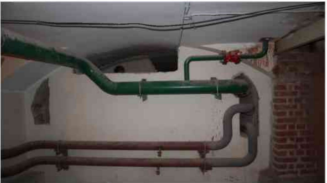
Фото п.85. Подвал, помещение 9Н (21).
