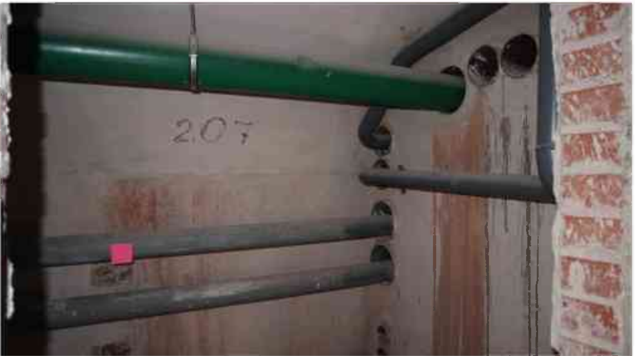
Фото п.198 Подвал, помещение 9Н (21).
