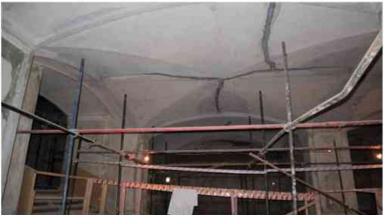
Фото 1.293. 1 этаж, помещение 13Н (4).
