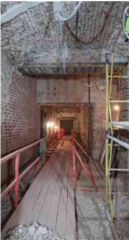
Фото 1.205. 1 этаж, помещение 12Н (2).
