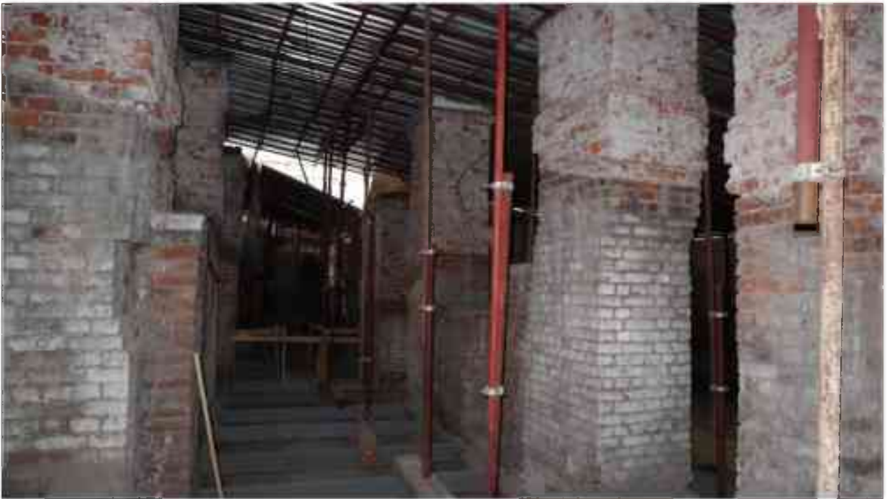
Фото 6.36. 6 этаж, чердачное помещение.
