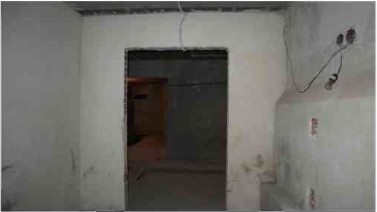
Фото п.235. Подвал, помещение 9Н (24).
