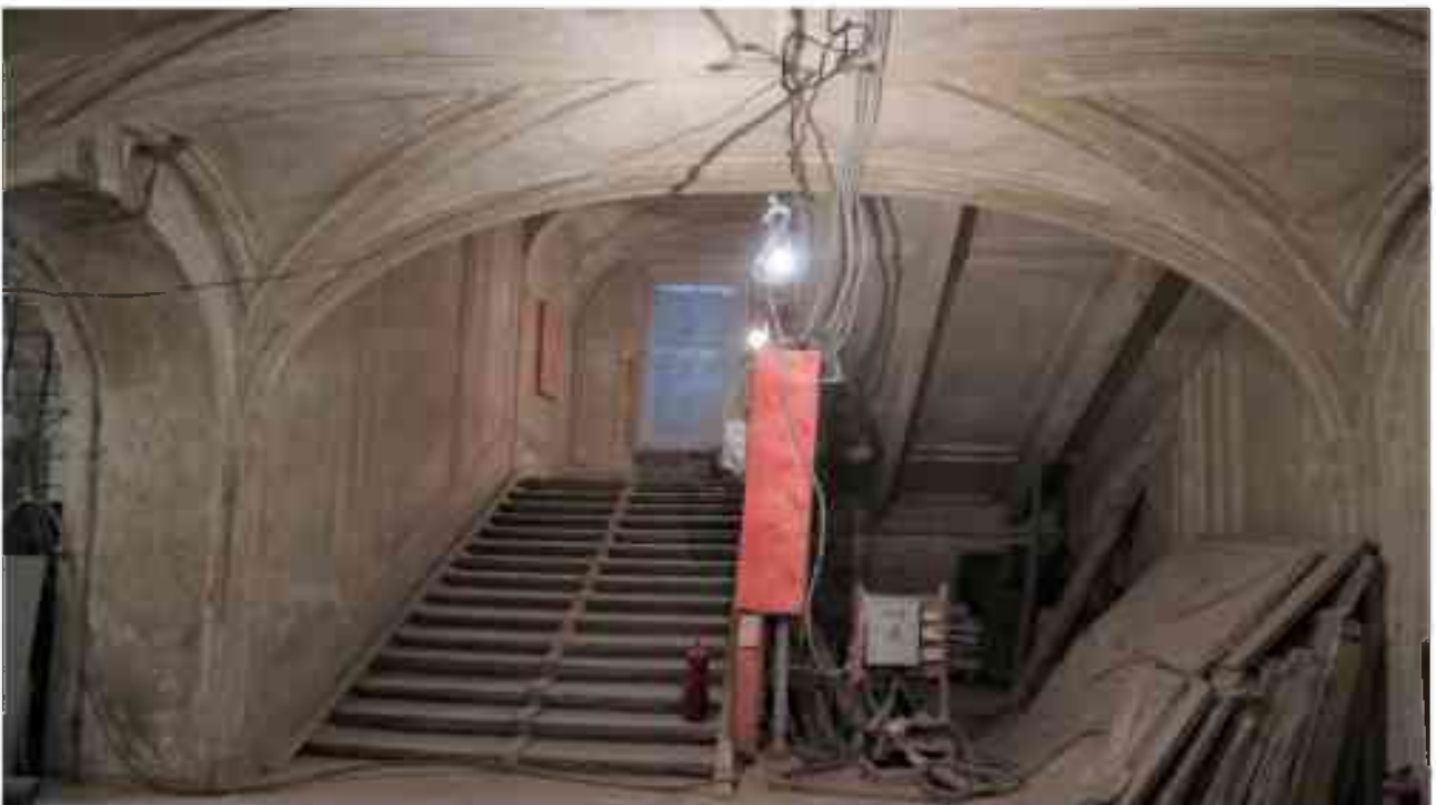
Фото 1.148. 1 этаж, лестница Л-14.
