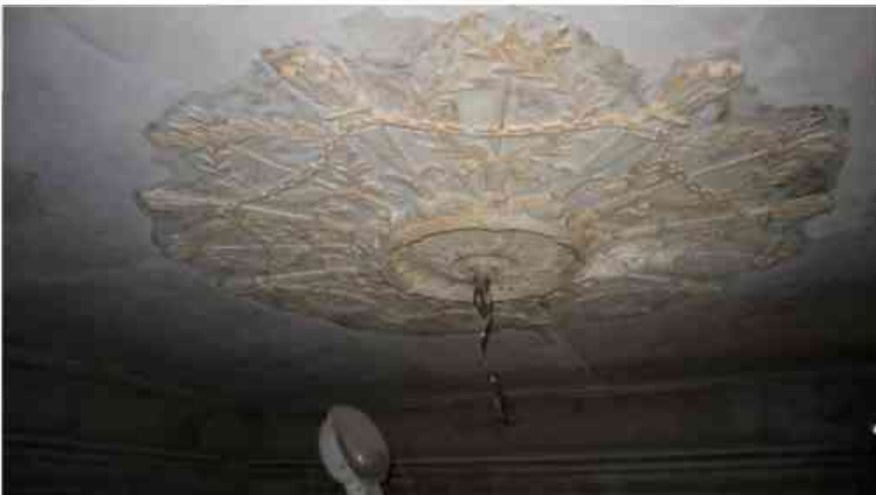
Фото 2.72. 2 этаж, помещение 22Н (31).*
