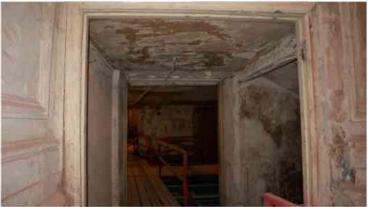
Фото 2.179. 2 этаж, помещение 22Н (15-16).
