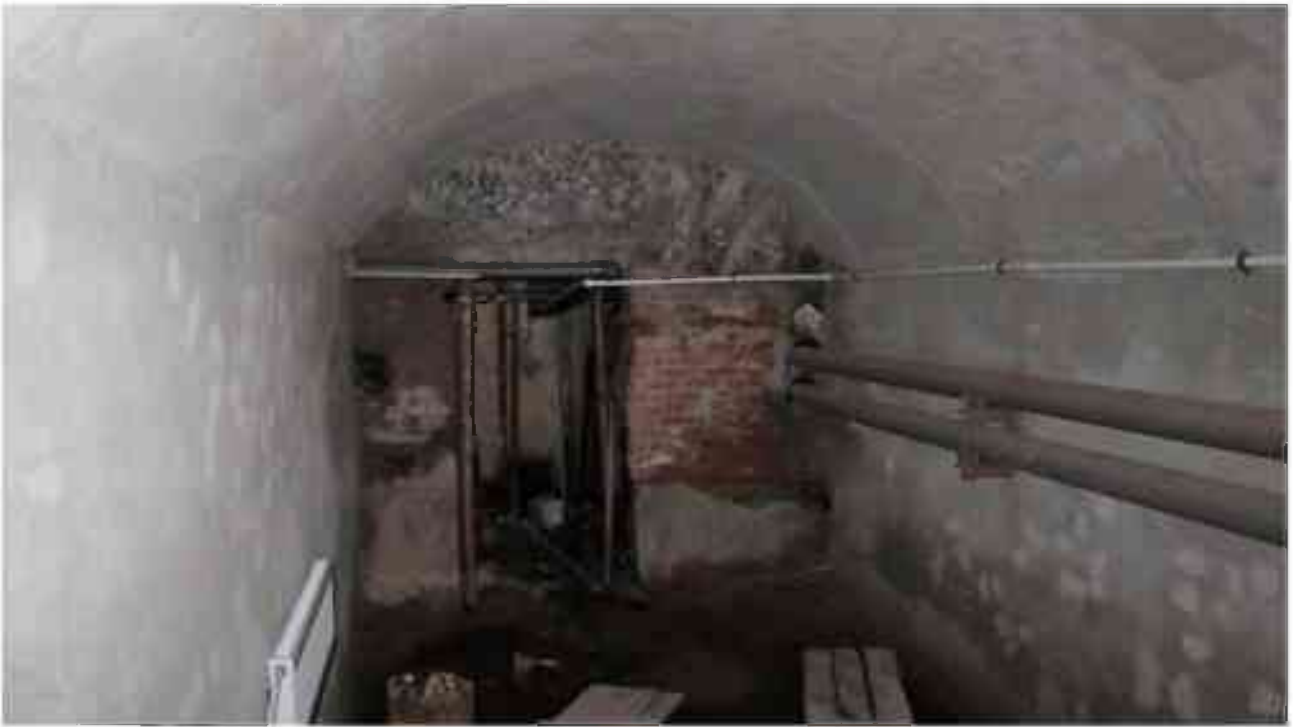
Фото п.70. Подвал, помещение 3Н (3).
