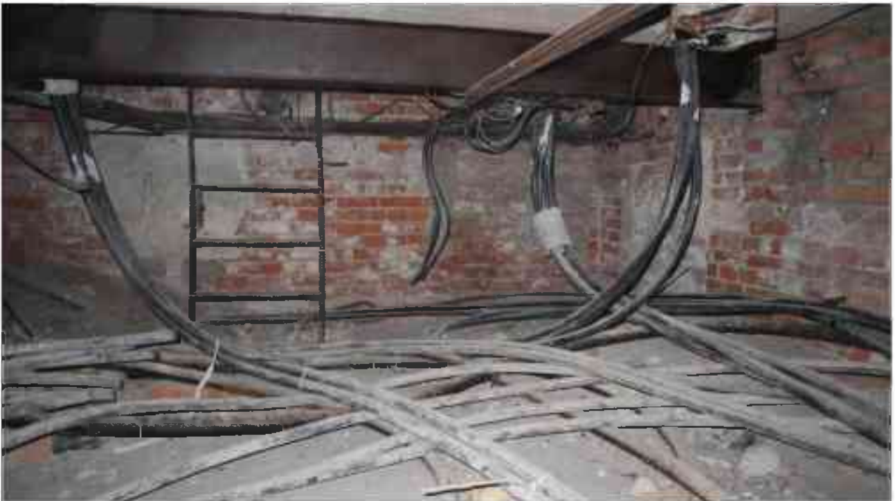
Фото п.347. Подвал, помещение 2Н (6).
