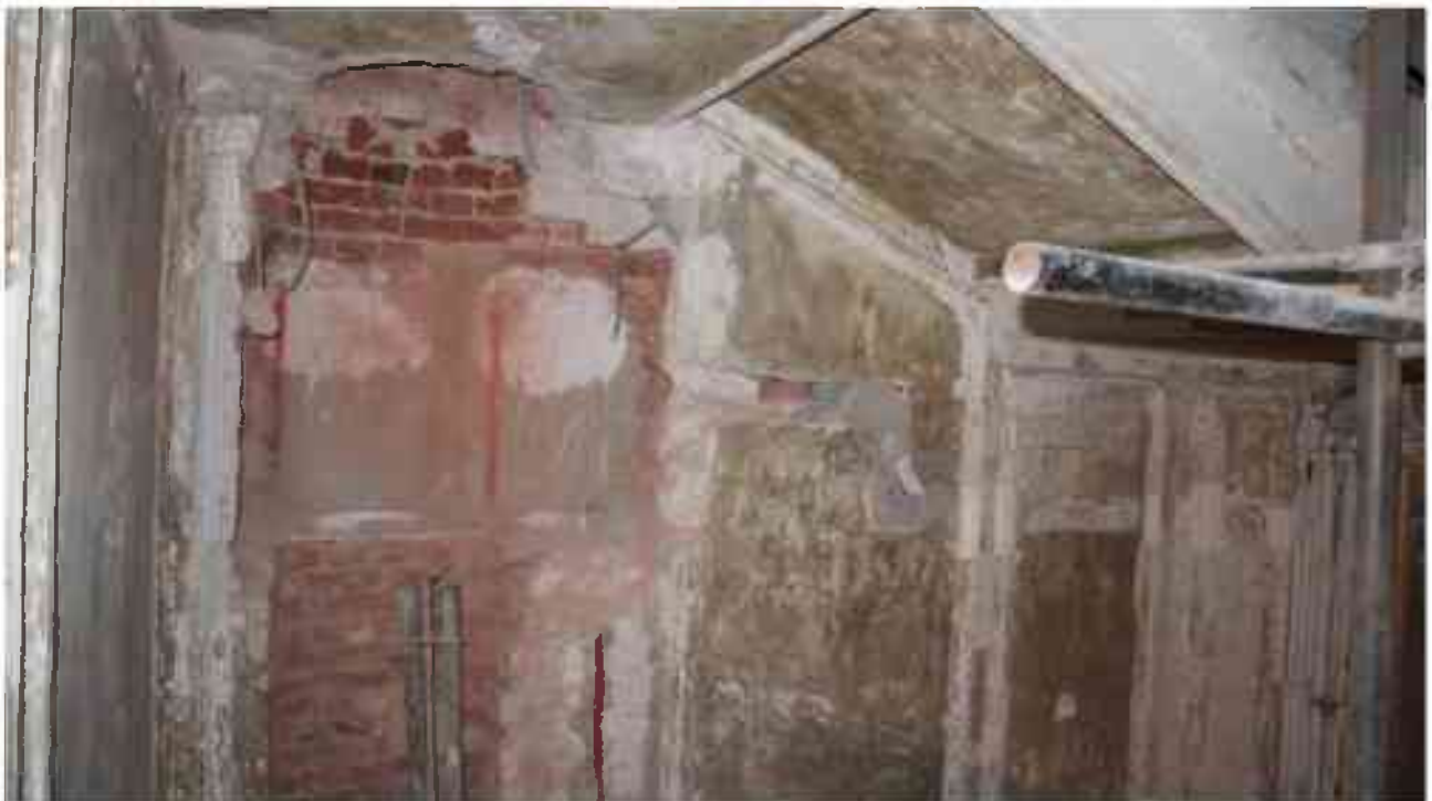
Фото 2.167. 2 этаж, лестница Л-10.
