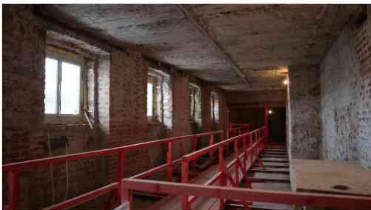
Фото 5.37. 5 этаж, помещение 38Н (1).
