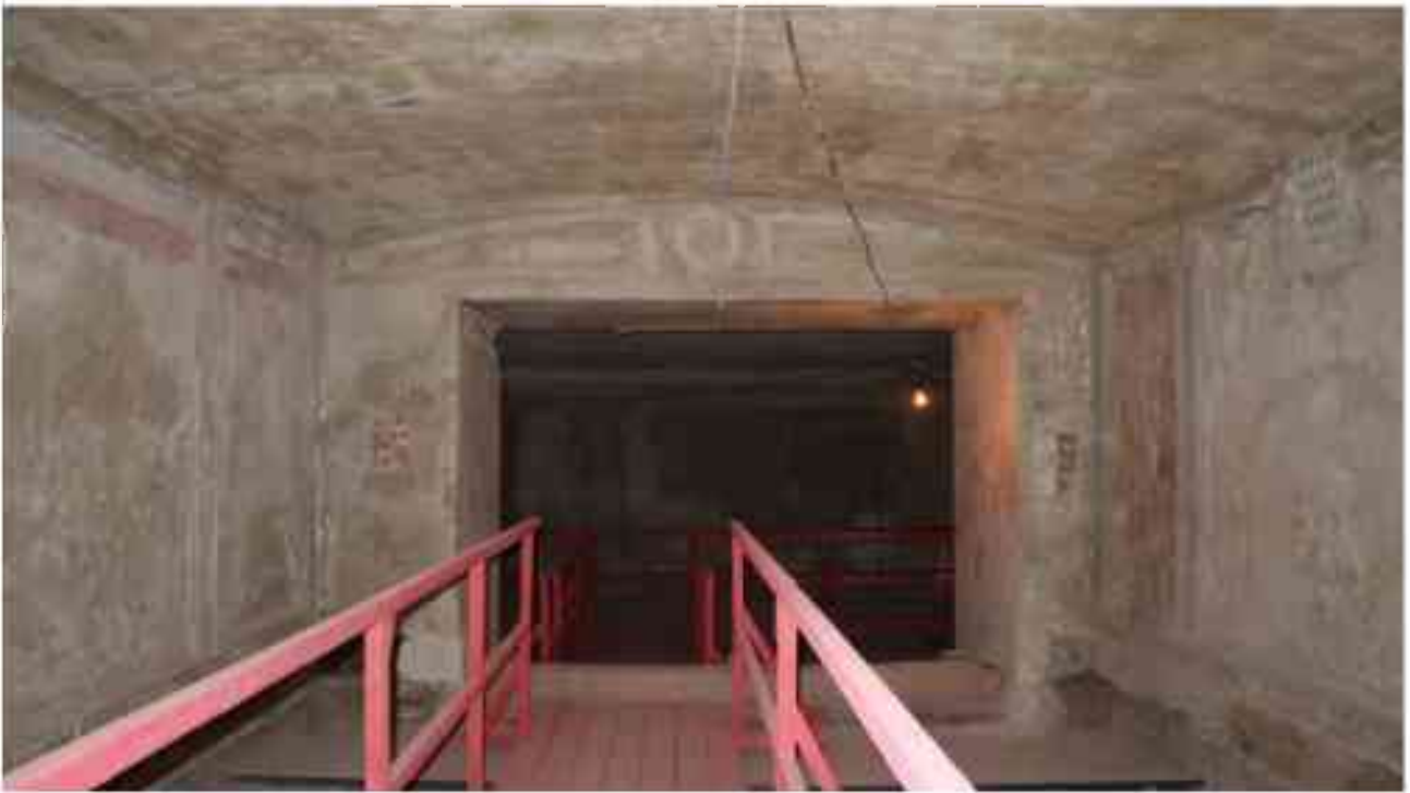
Фото 3.117. 3 этаж, помещение 25Н (2).
