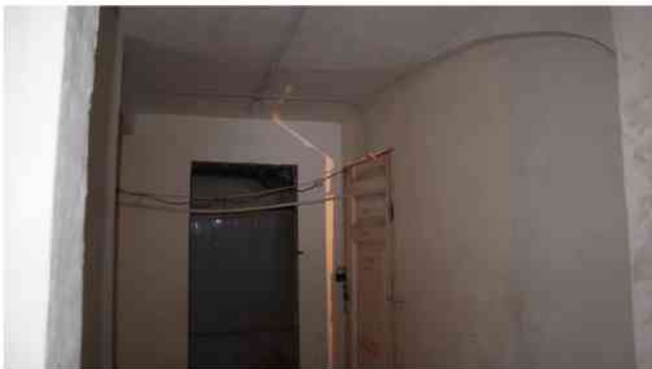
Фото п.264. Подвал, помещение 6Н (5-6).
