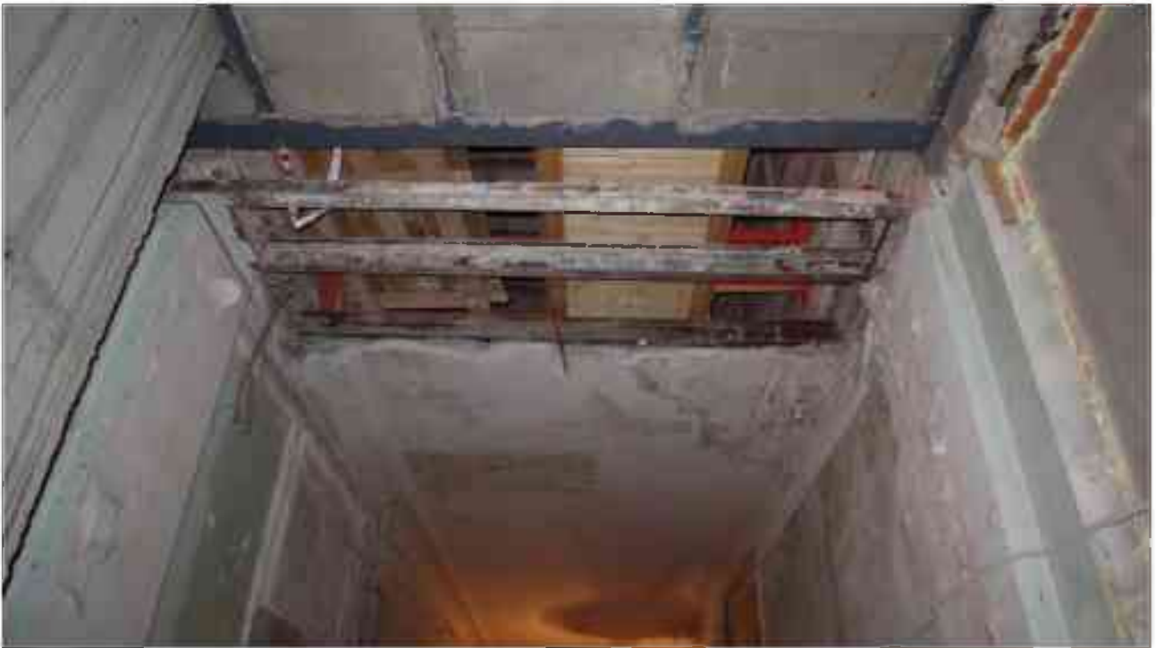
Фото 2.172. 2 этаж, помещение 22Н (17).
