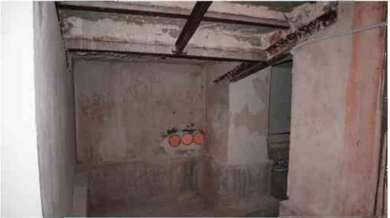
Фото п.206. Подвал, помещение 9Н (5).
