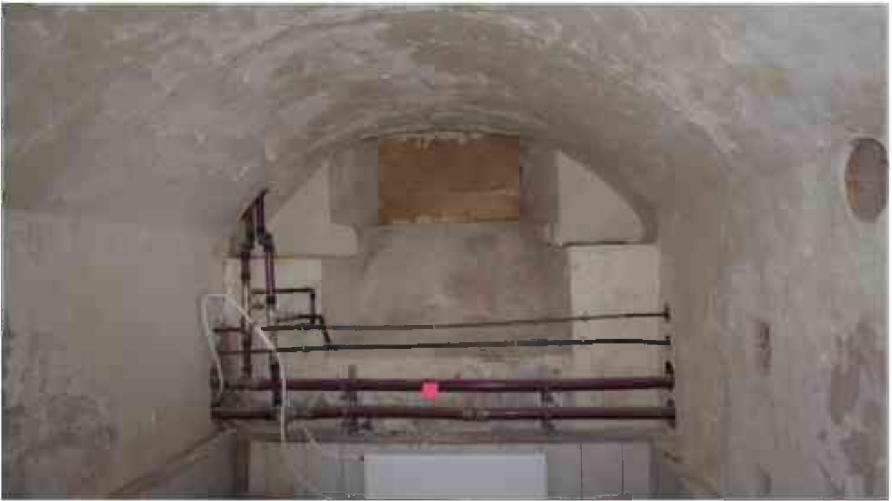
Фото п.154. Подвал, помещение 9Н (16).
