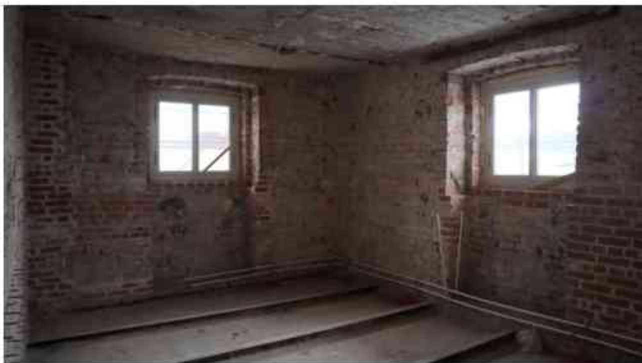
Фото 5.36. 5 этаж, помещение 38Н (1).
