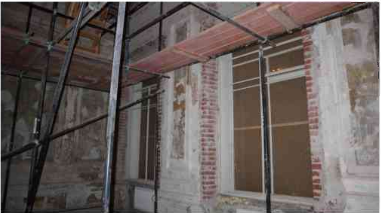
Фото 2.132. 2 этаж, помещение 22Н (18).
