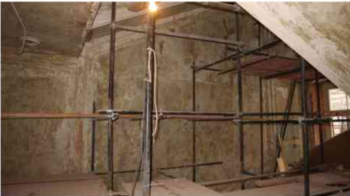
Фото 3.133. 3 этаж, лестница с перекрестными маршами, трехмаршевая, в центре здания.*
