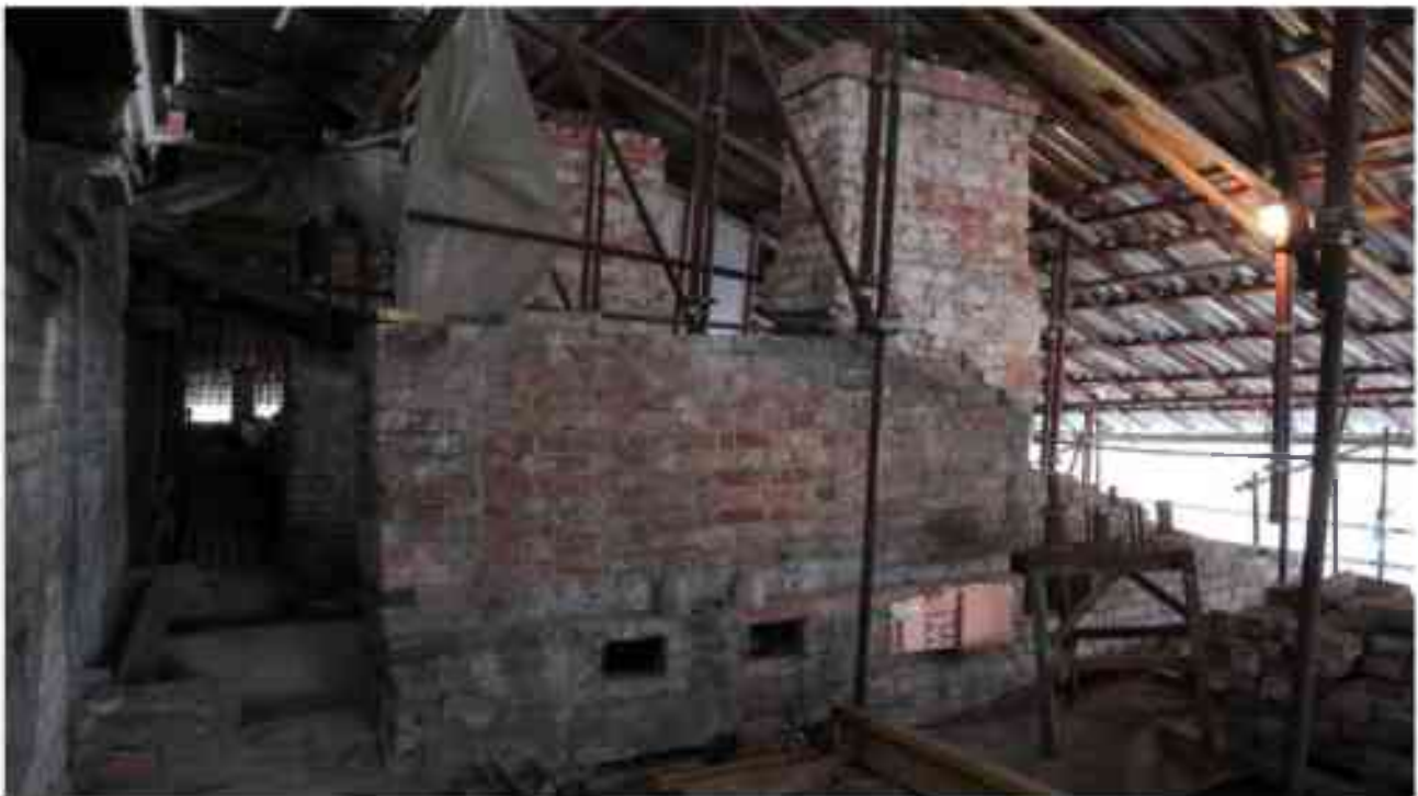
Фото 6.49. 6 этаж, чердачное помещение.
