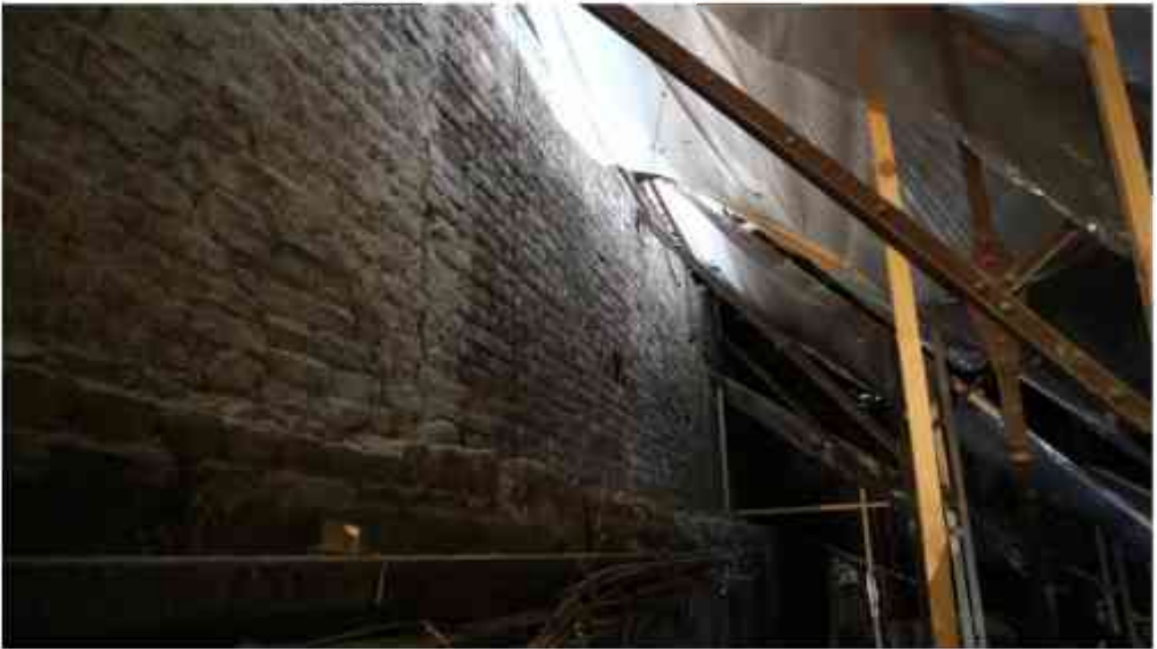
Фото 5.116. Чердак уровня 5 этажа.
