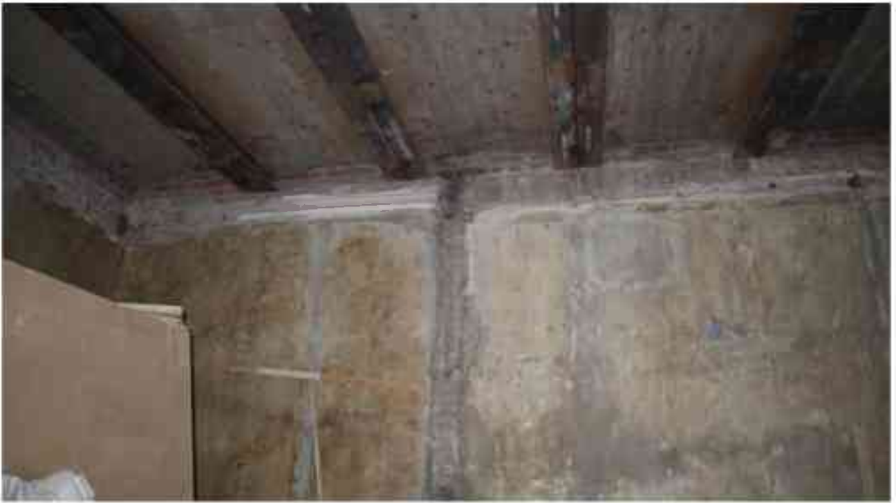
Фото 2.98. 2 этаж, помещение 22Н (33-35, 38-40).
