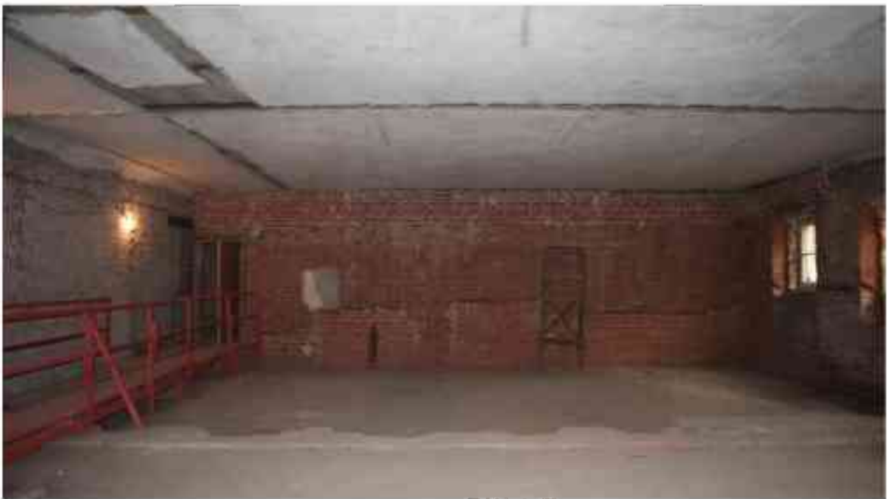
Фото 5.91. 5 этаж, помещение 34Н(3-11).
