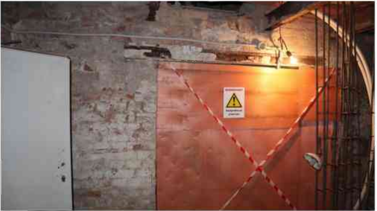
Фото п.324. Подвал, помещение 18Н (6).
