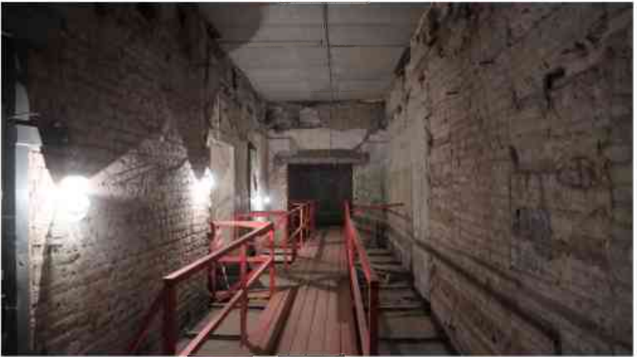
Фото 1.209. 1 этаж, помещение 15Н (5-6).
