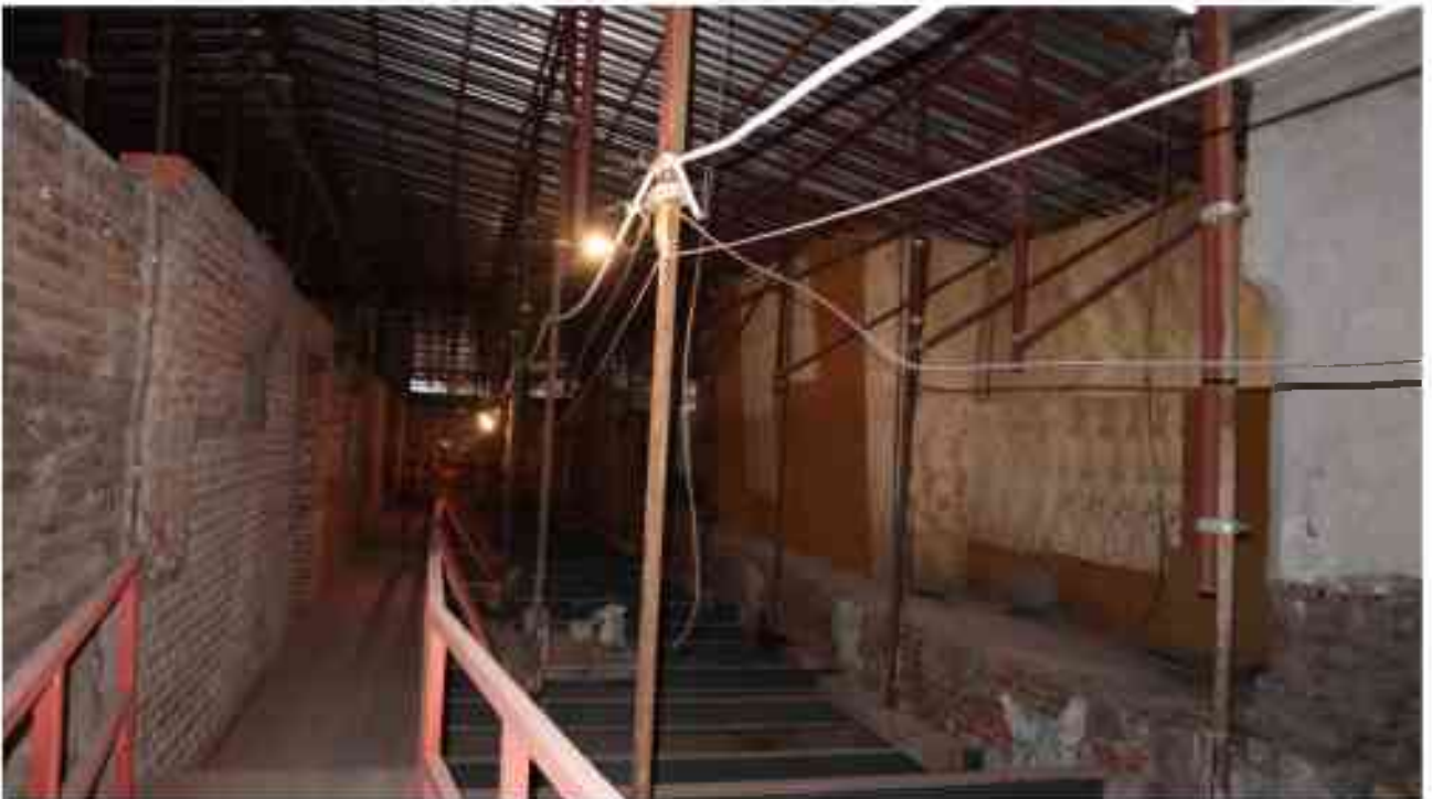
Фото 5.177. 5 этаж, коридор, помещения 34Н/37Н.
