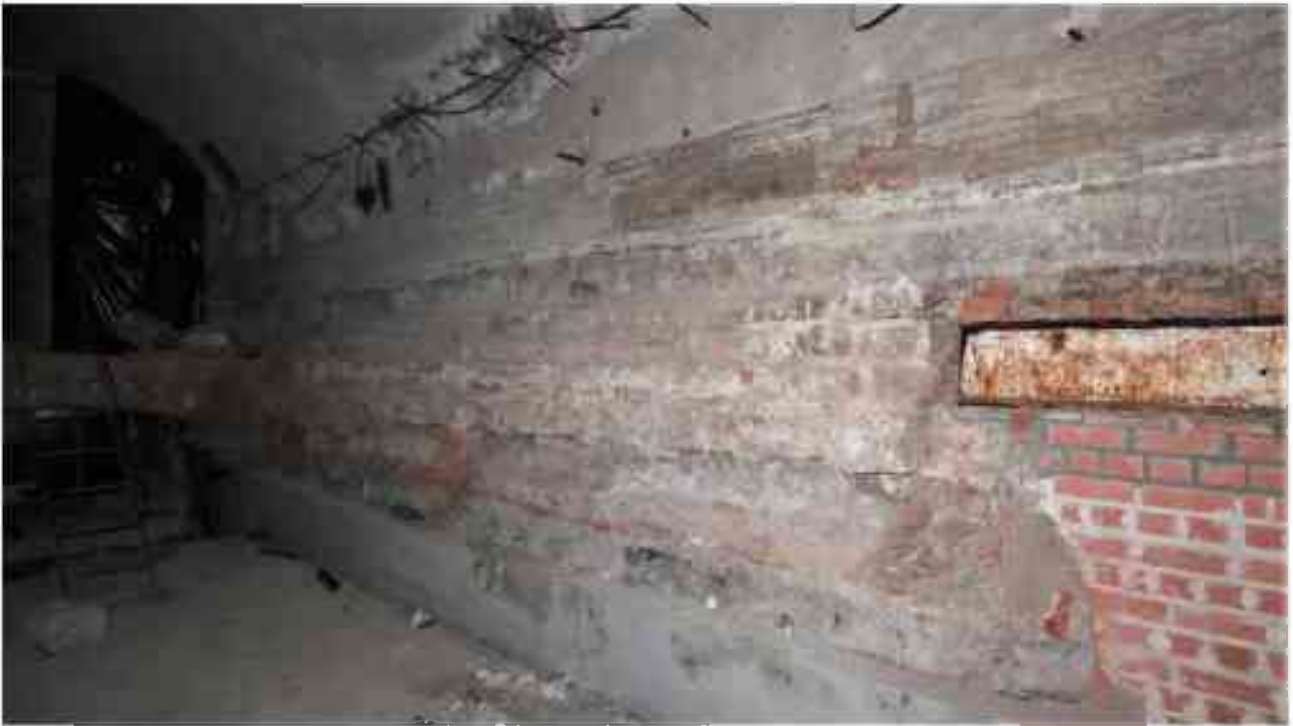
Фото п.316. Подвал, помещение 9Н (1).
