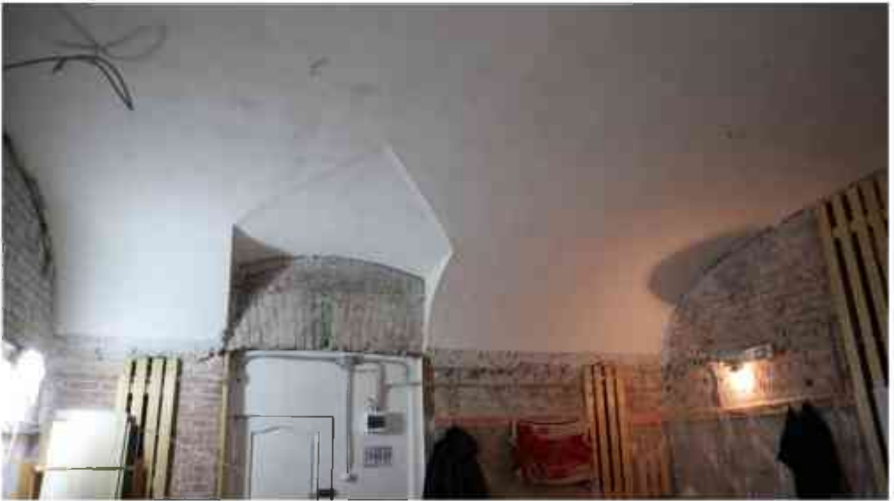
Фото 2.45. 2 этаж, помещение 22Н (53).
