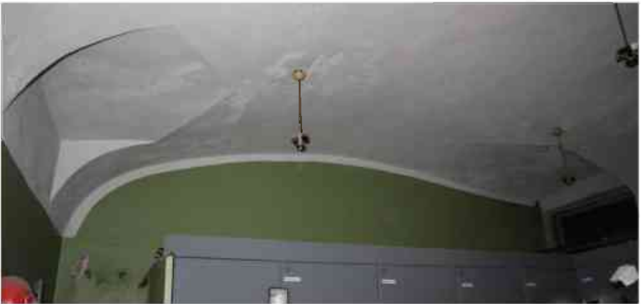
Фото 2.245. 2 этаж, помещение 22Н (57).
