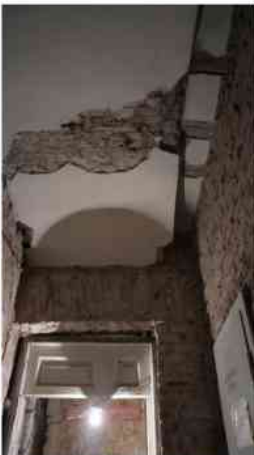
Фото 3.100. 3 этаж, помещение 28Н (4).
