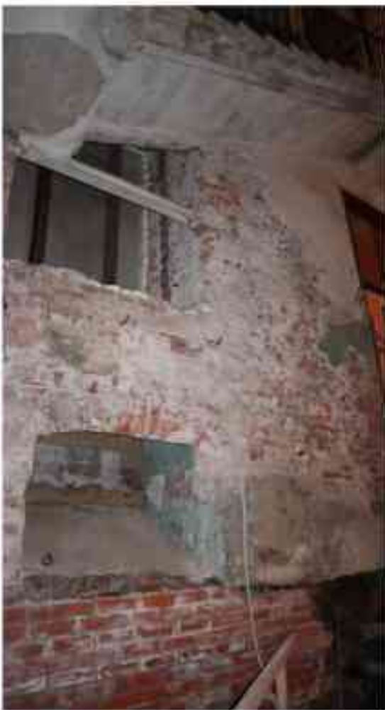
Фото п.69. Подвал, лестница Л-3.
