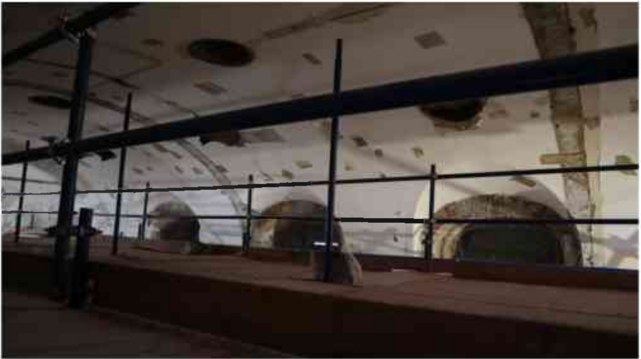
Фото 3.52. 3 этаж, помещение 28Н (20-21).*
