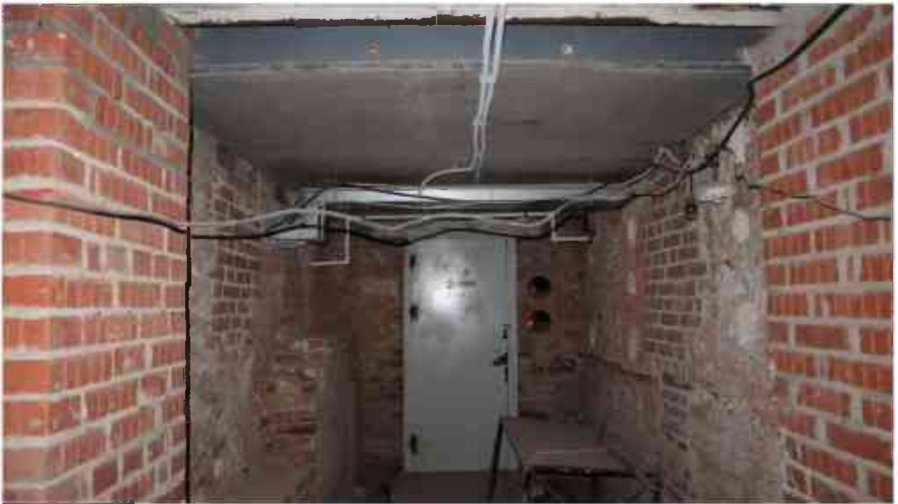
Фото п.19. Подвал, помещение 3Н (9).
