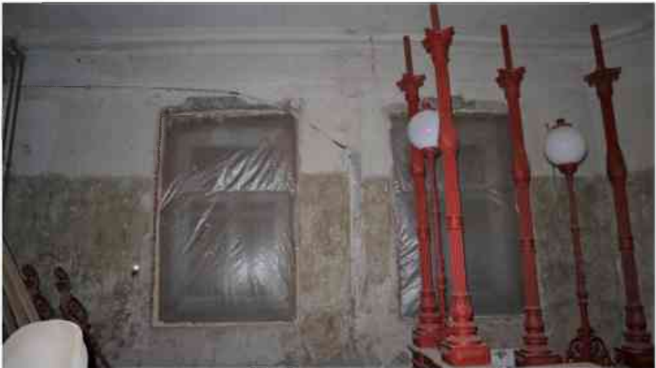
Фото 1.322. 1 этаж, помещение 13Н (11-14).
