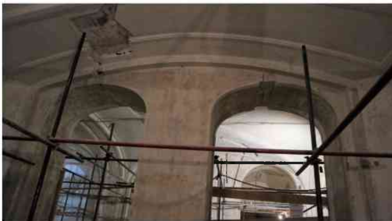
Фото 1.290. 1 этаж, помещение 13Н (4).
