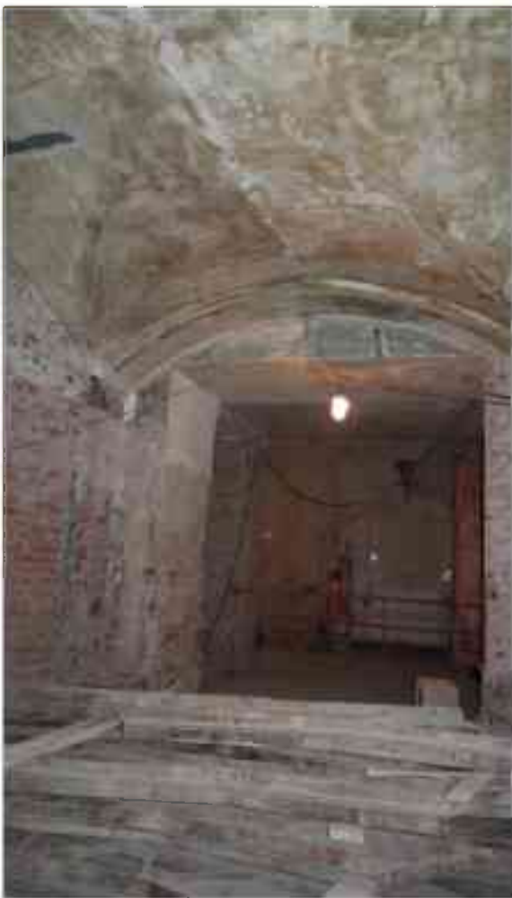
Фото 1.303. 1 этаж, помещение 13Н (3).
