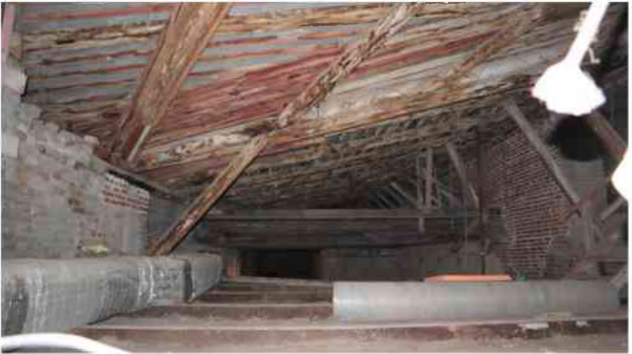
Фото 6.62. 6 этаж, чердачное помещение.
