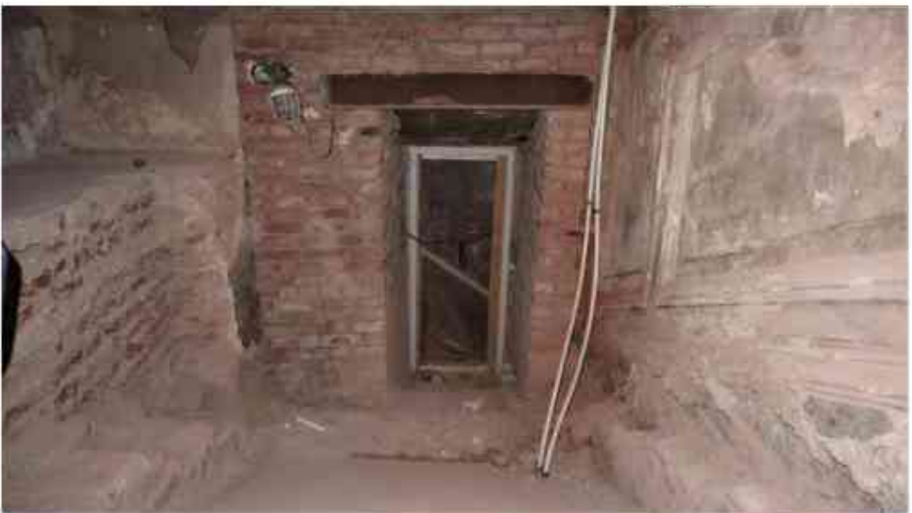
Фото 1.348. 1 этаж, помещение в центре здания, западнее лестницы с перекрестными маршами.*
