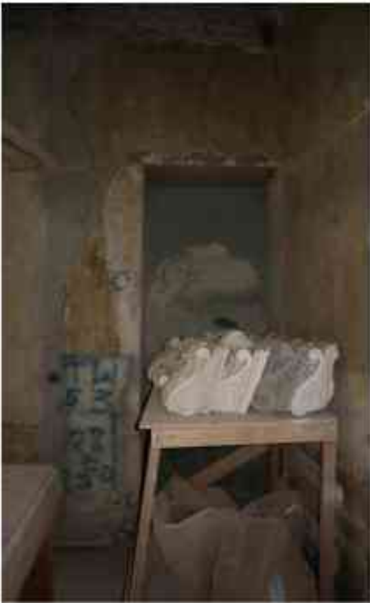
Фото 2.96. 2 этаж, помещение 22Н (33-35, 38-40).
