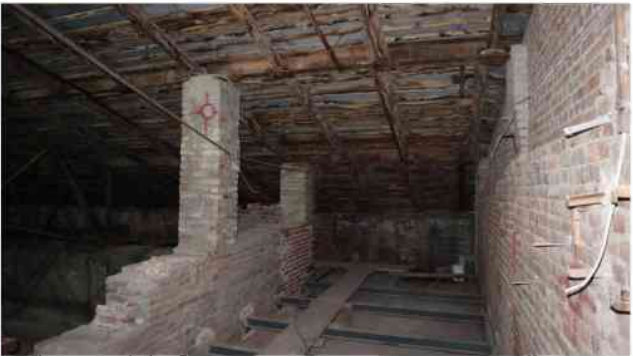
Фото 5.79. 5 этаж, чердачное помещение, купол.
