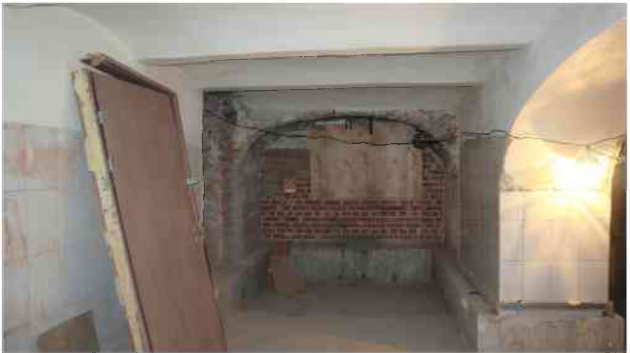
Фото п.283. Подвал, помещение 6Н (13).
