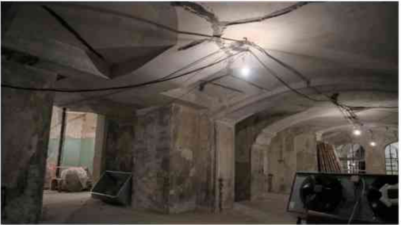
Фото 1.304. 1 этаж, помещение 13Н (4).
