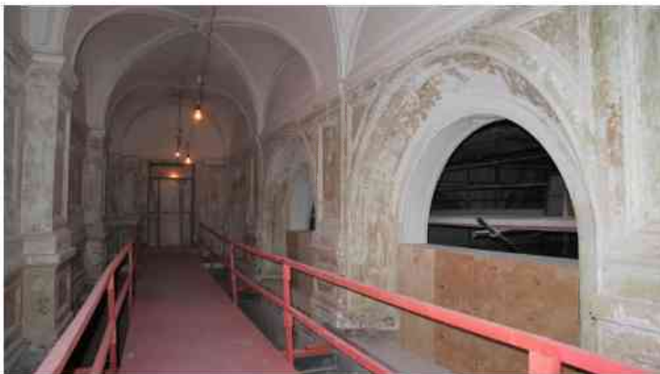
Фото 4.161. 4 этаж, помещение 30Н (4).
