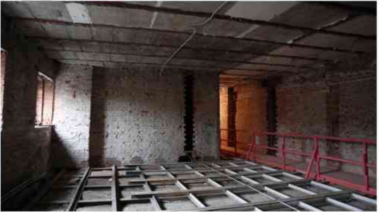
Фото 5.55. 5 этаж, помещение 35Н (12-17).
