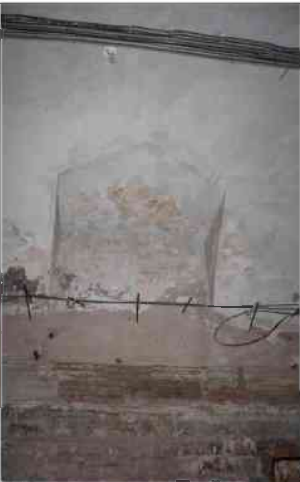
Фото п.319. Подвал, помещение 9Н (1).
