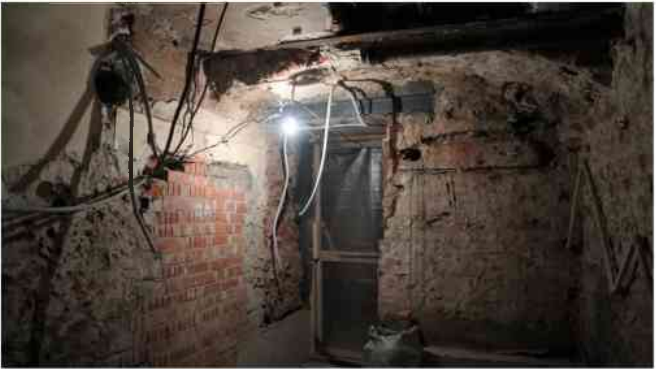
Фото п.224. Подвал, помещение 9Н (2), лестница Л-17.
