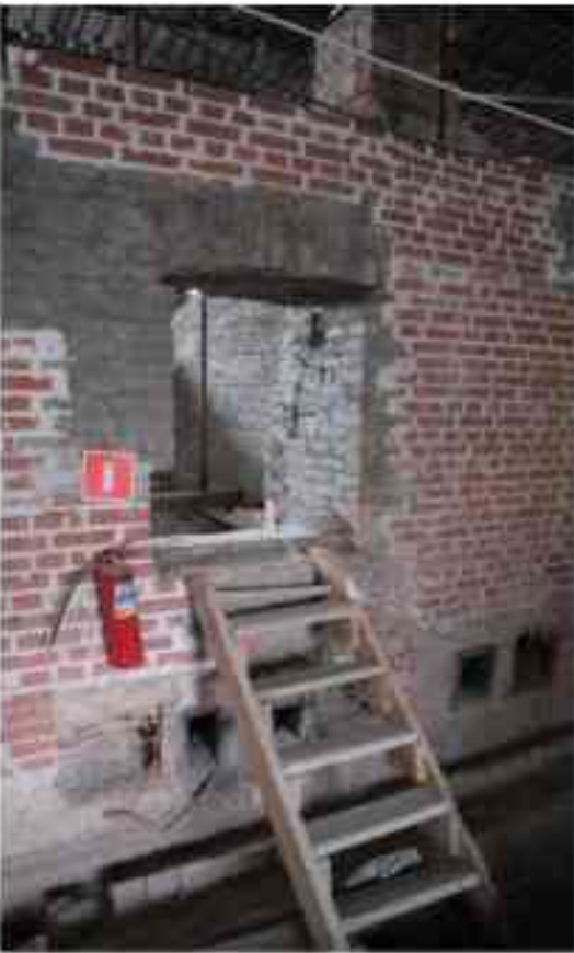
Фото 5.129. 5 этаж, коридор, помещения 34Н/37Н.
