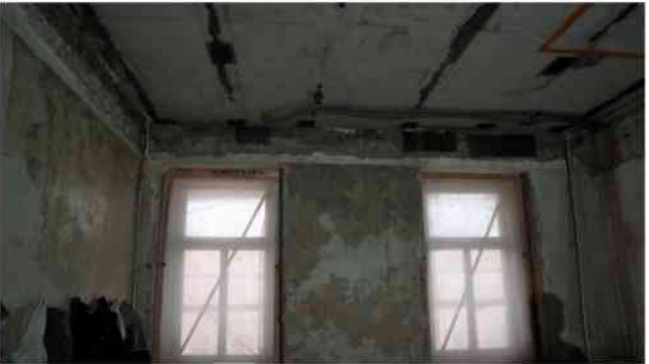
Фото 3.4. 3 этаж, помещение 28Н (36).
