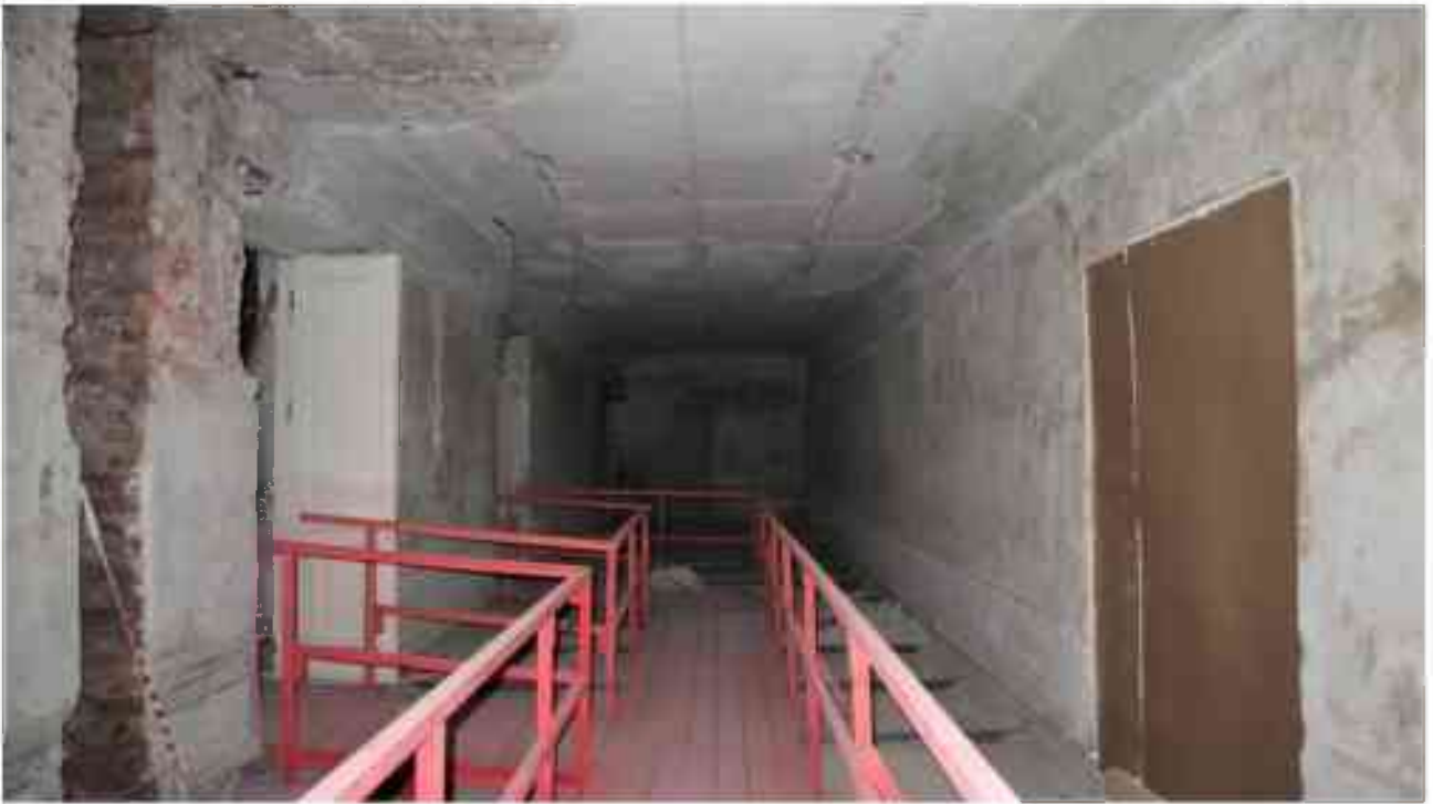
Фото 4.167. 4 этаж, помещение 30Н (7).
