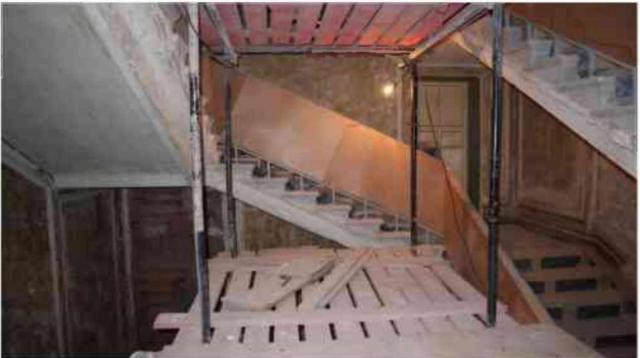
Фото 2.121. 2 этаж, лестница Л-13.
