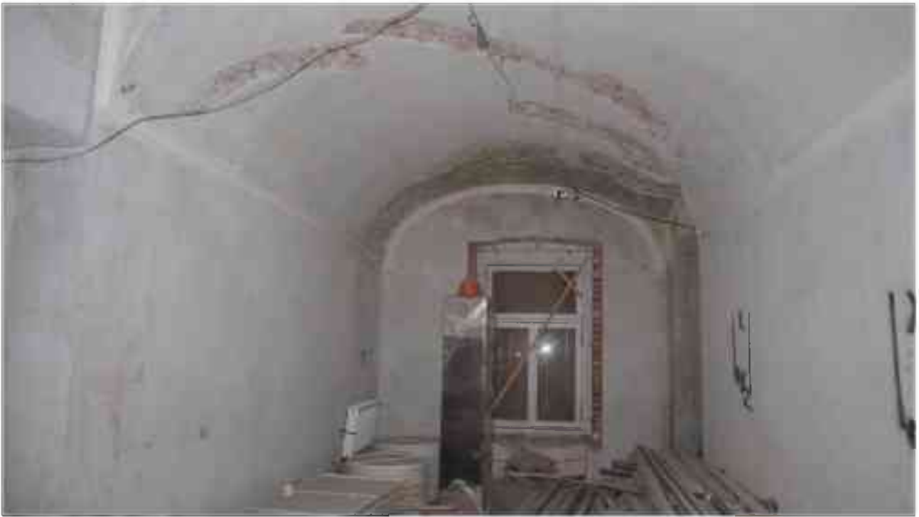
Фото 1.65. 1 этаж, помещение 14Н (22).
