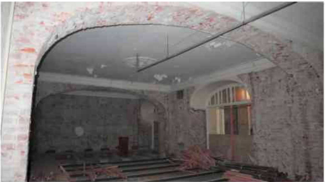
Фото 2.22. 2 этаж, помещение 22Н (48).
