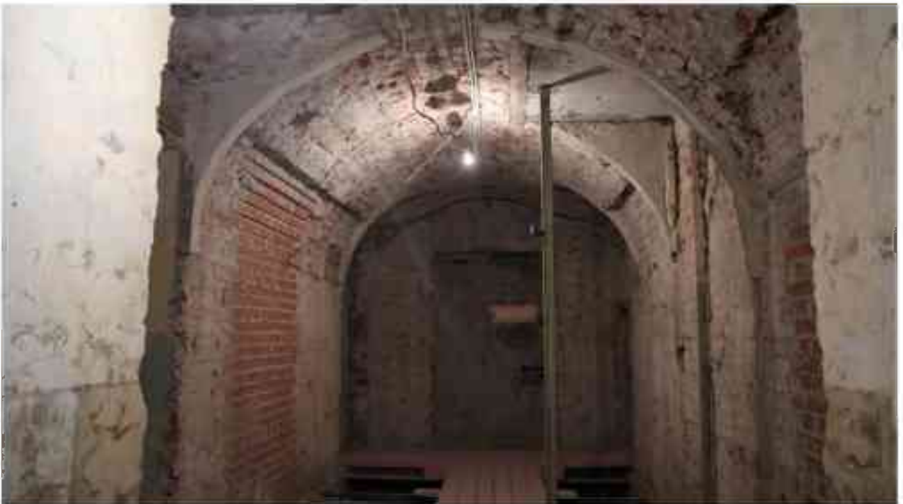
Фото 4.104. 4 этаж, помещение 42Н* (2).
