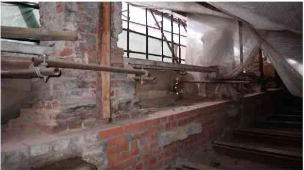
Фото 5.167. 5 этаж, чердачное помещение.
