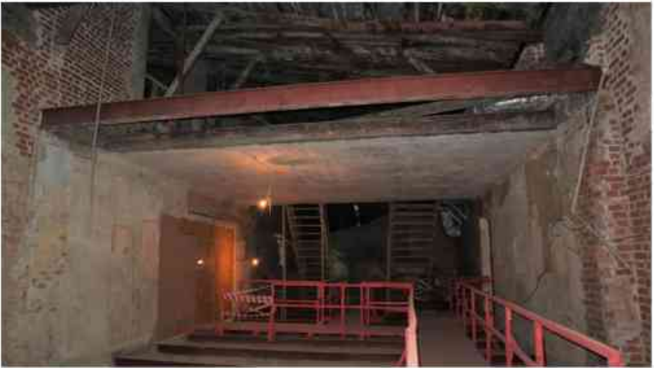
Фото 5.69. 5 этаж, помещение 35Н (4-6).
