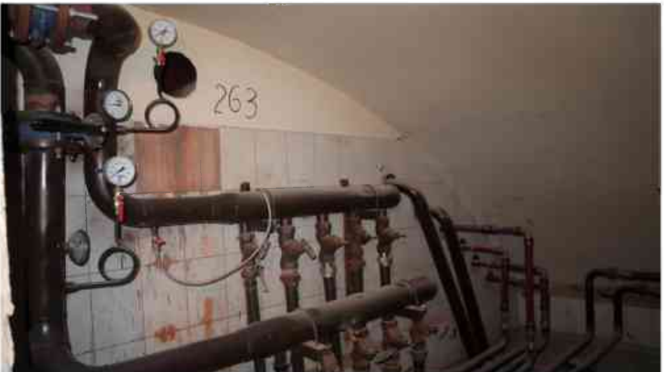
Фото п.167. Подвал, помещение 9Н (10).
