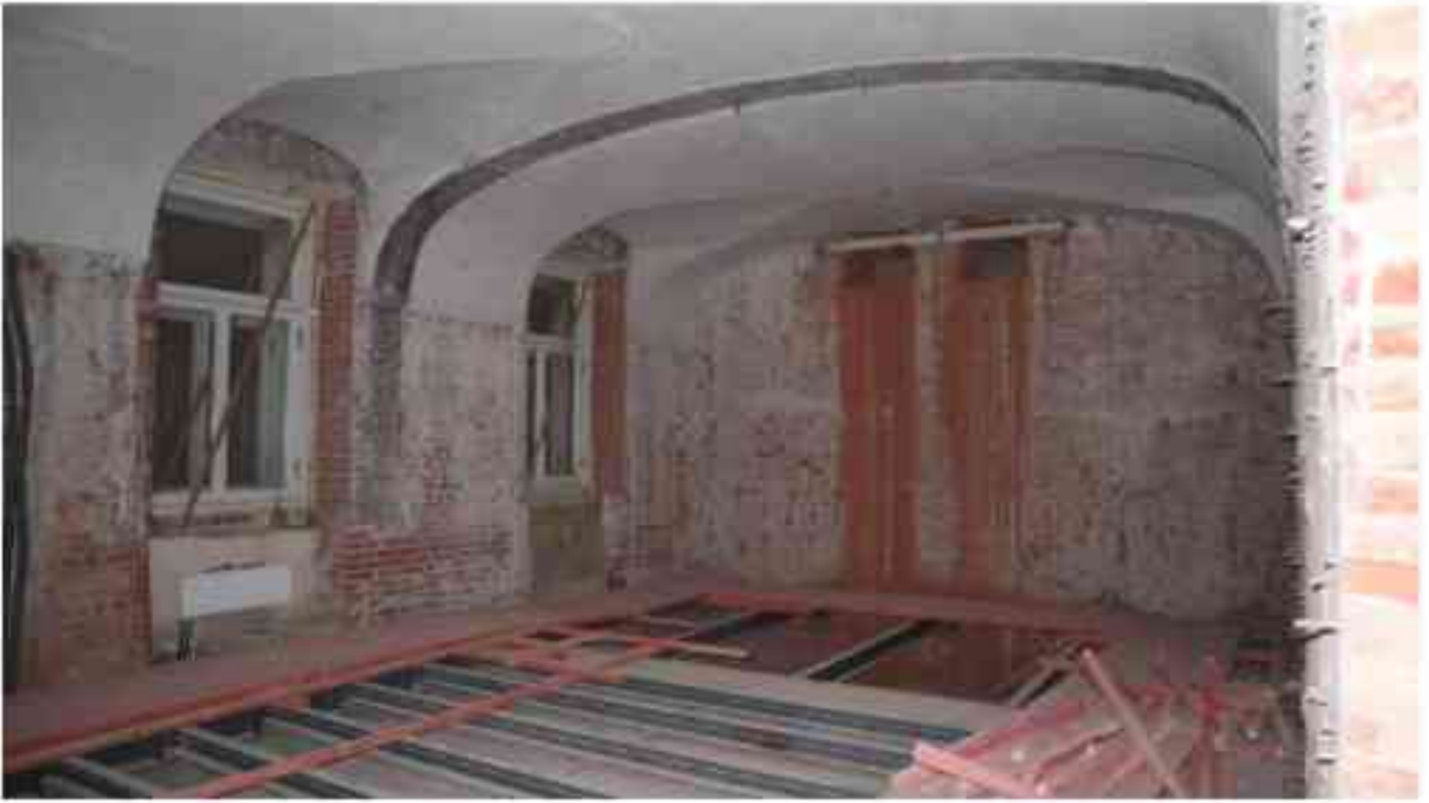
Фото 2.9. 2 этаж, помещение 22Н (45-46).
