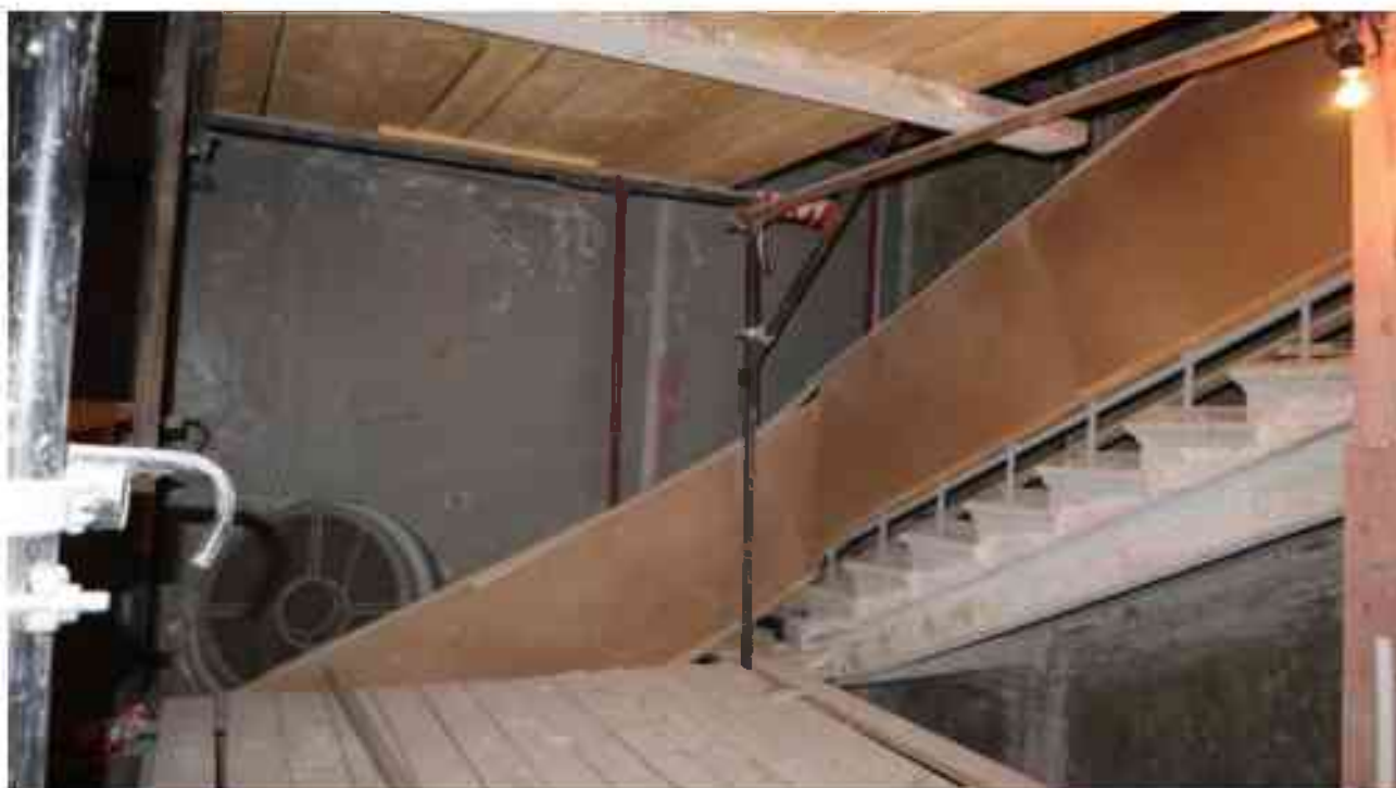
Фото 3.144. 3 этаж, лестница в ризалите южного фасада (западная часть).*
