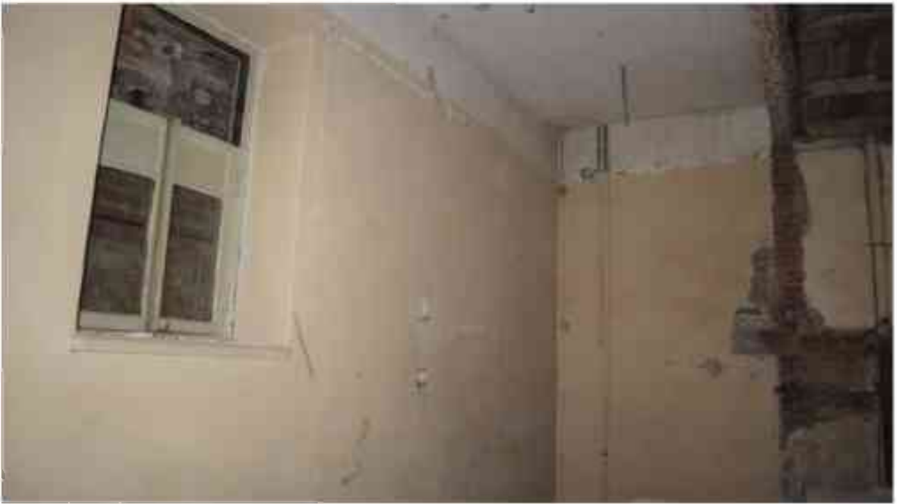
Фото 3.69. 3 этаж, помещение 28Н (1, 3-4).
