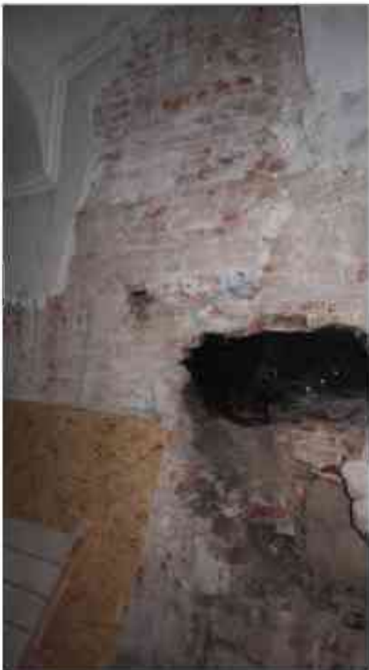
Фото 2.6. 2 этаж, помещение 22Н (42).
