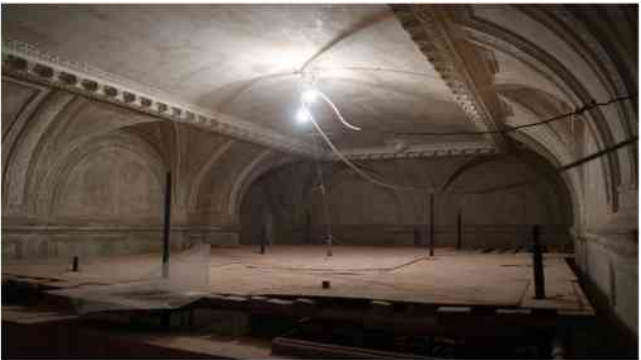
Фото 4.23. 4 этаж, помещение 33Н (32).
