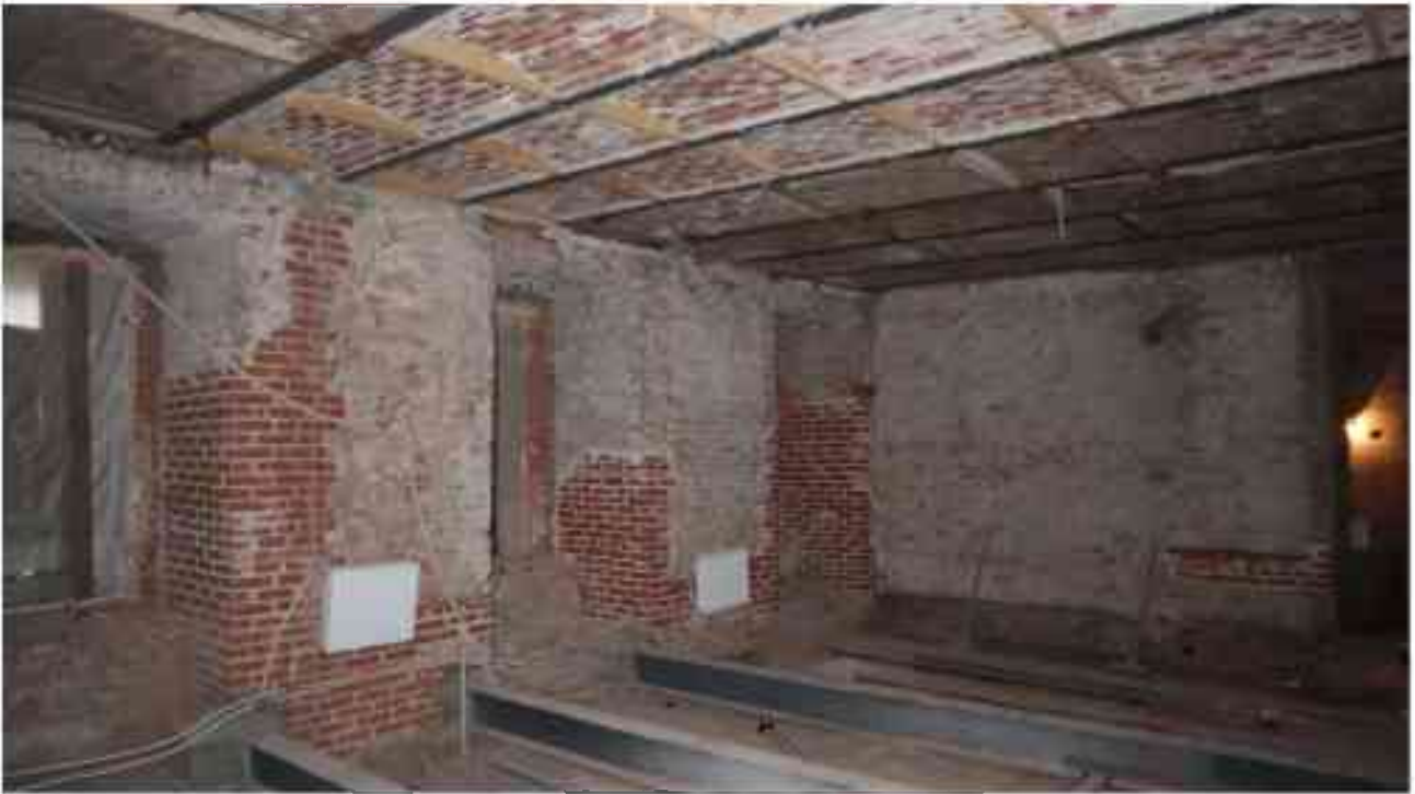
Фото 4.194. 4 этаж, помещение 42Н* (3-4, 8-9).
