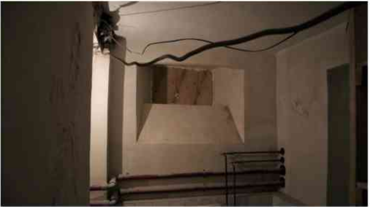
Фото п.135. Подвал, помещение 9Н (19).
