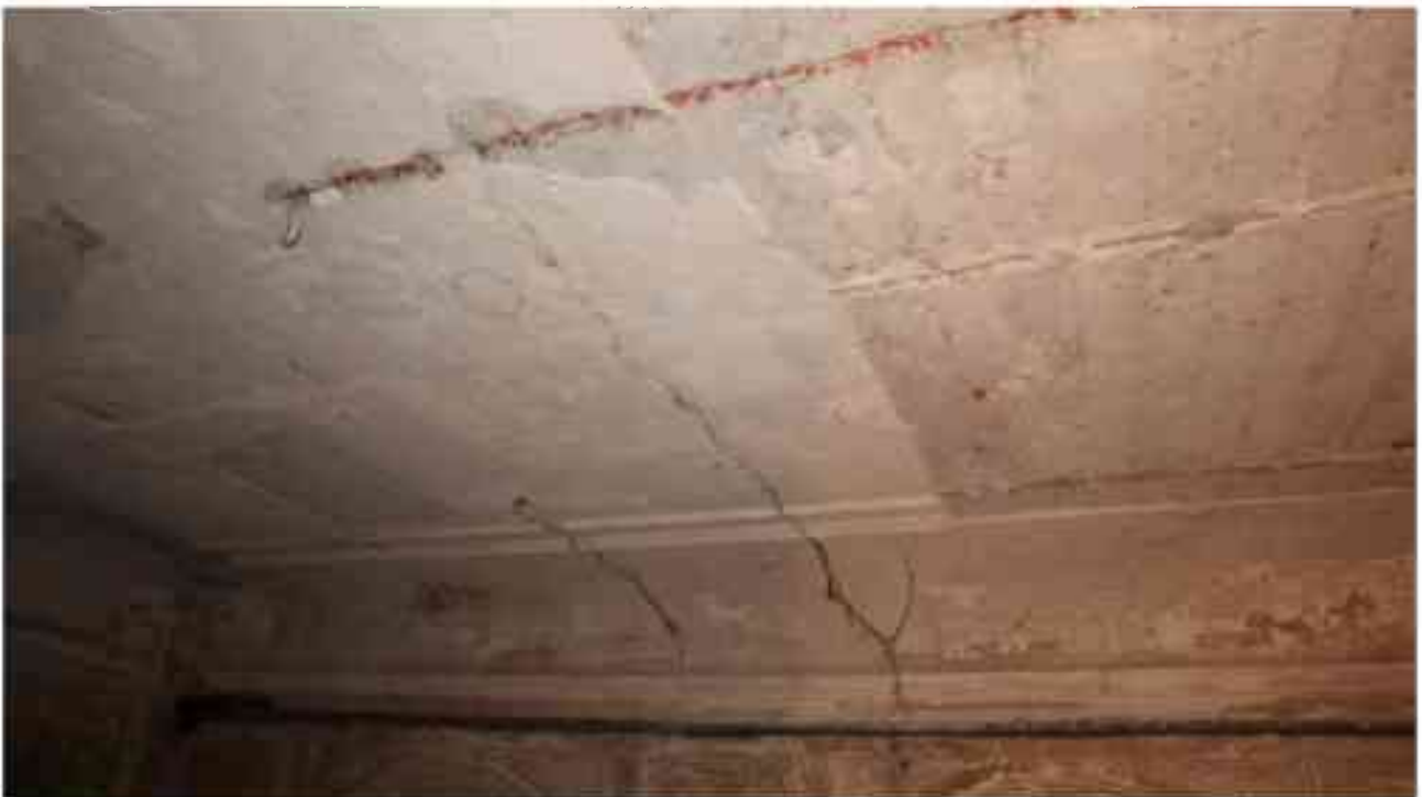
Фото 2.138. 2 этаж, помещение 22Н (18).*
