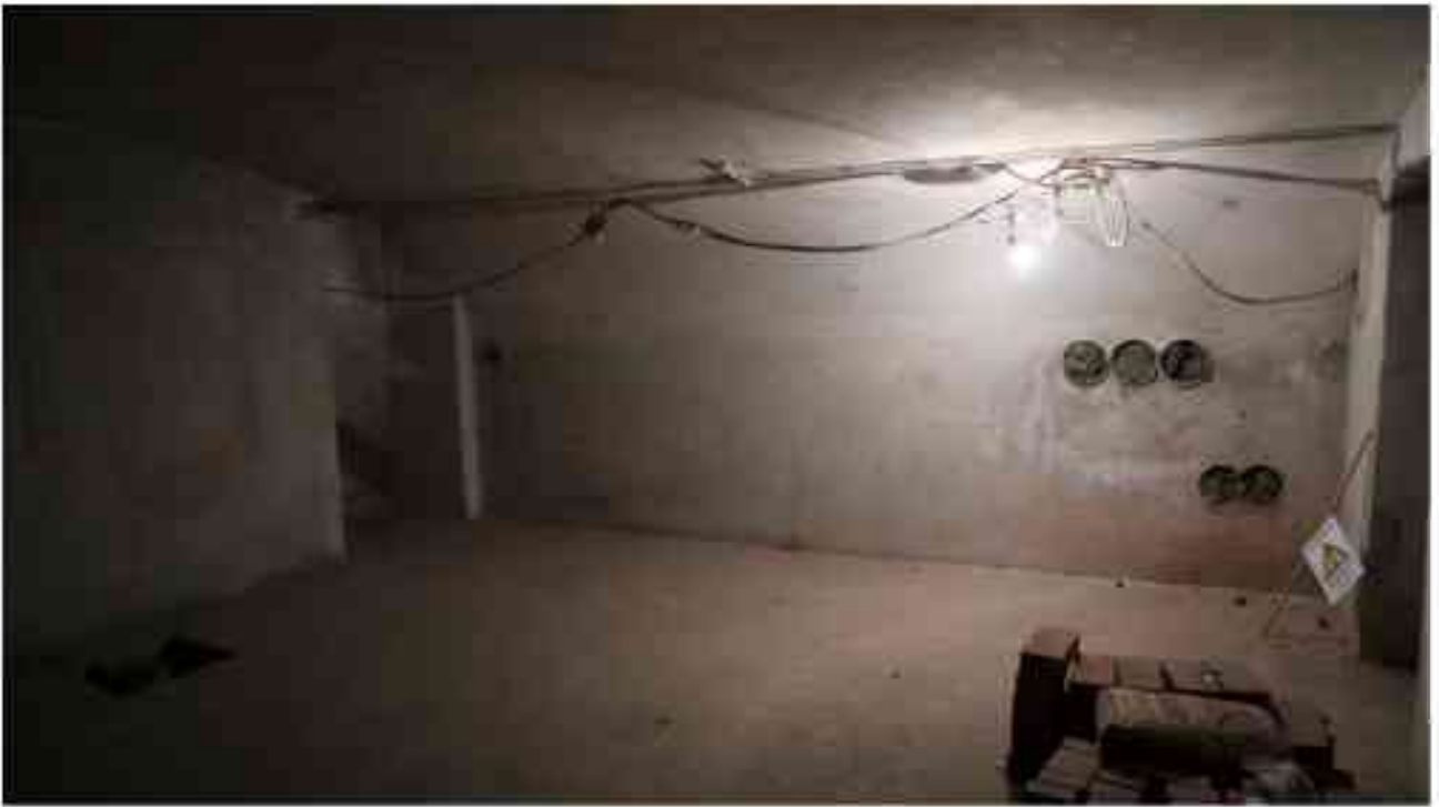
Фото п.13. Подвал, помещение 2Н (3).
