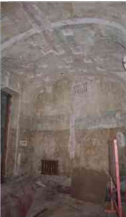
Фото 1.119. 1 этаж, помещение 31Н (5-6).
