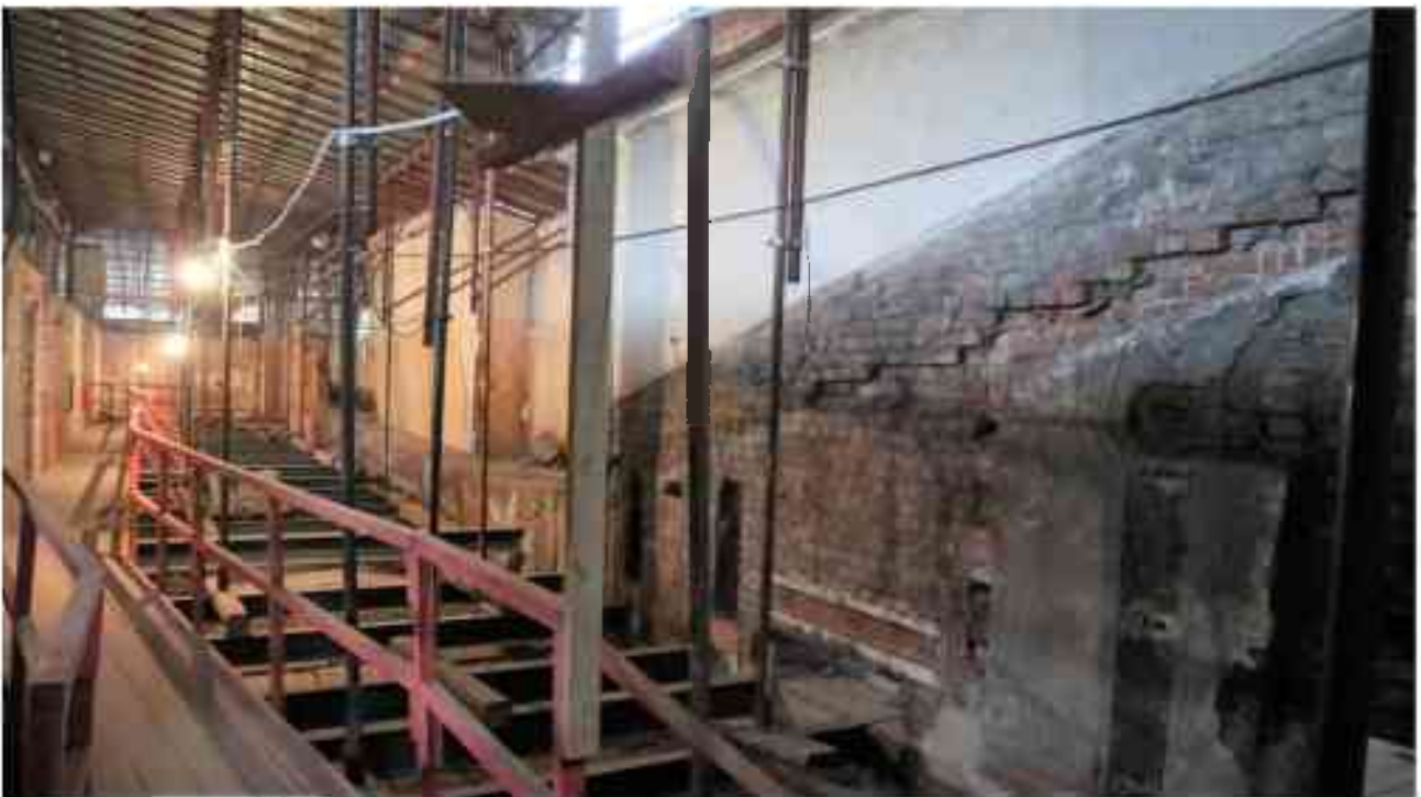
Фото 5.135. 5 этаж, коридор, помещения 34Н/37Н.
