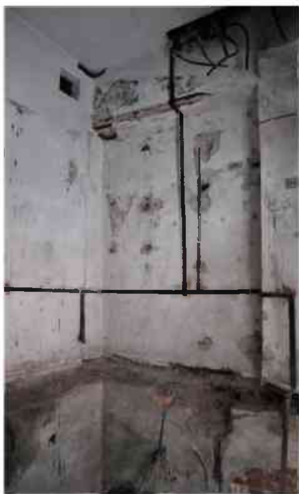
Фото 1.329. 1 этаж, помещение 16Н (1).
