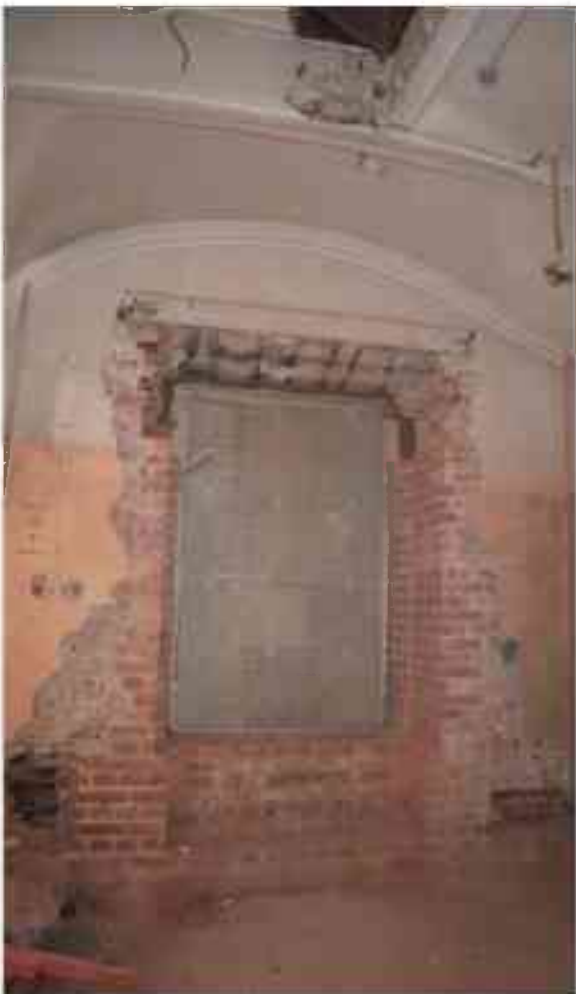
Фото 1.203. 1 этаж, помещение 12Н (1).
