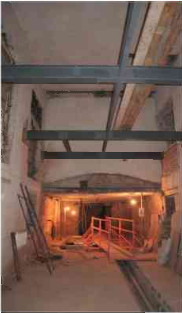
Фото п.334. Подвал, помещение 1Н (4-8).
