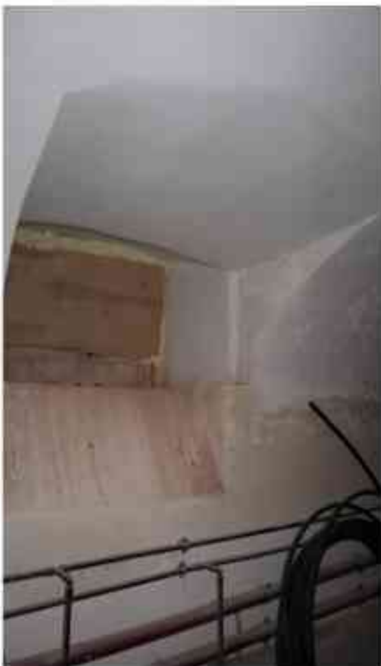
Фото п.131. Подвал, помещение 4Н (14-16).
