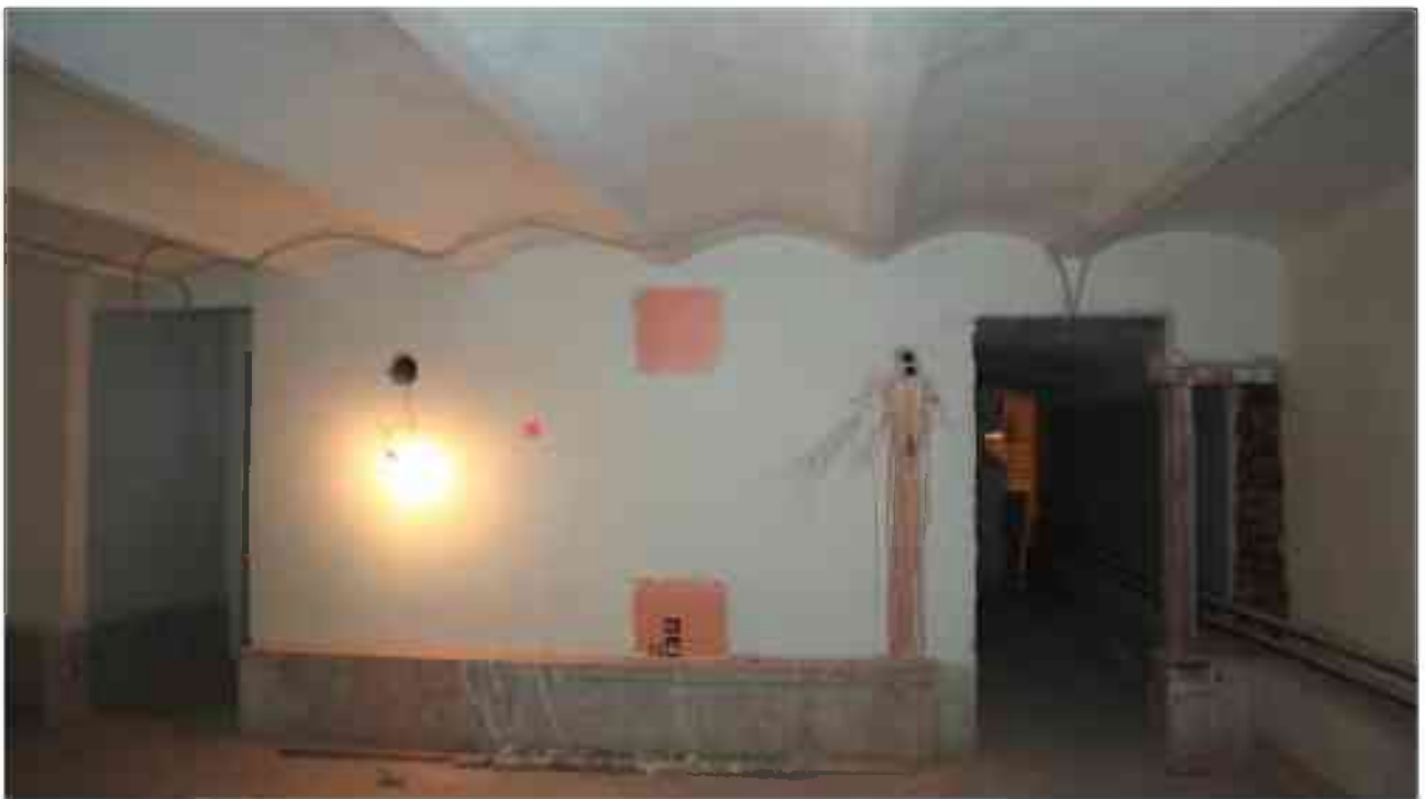
Фото п.261. Подвал, помещение 6Н (7).
