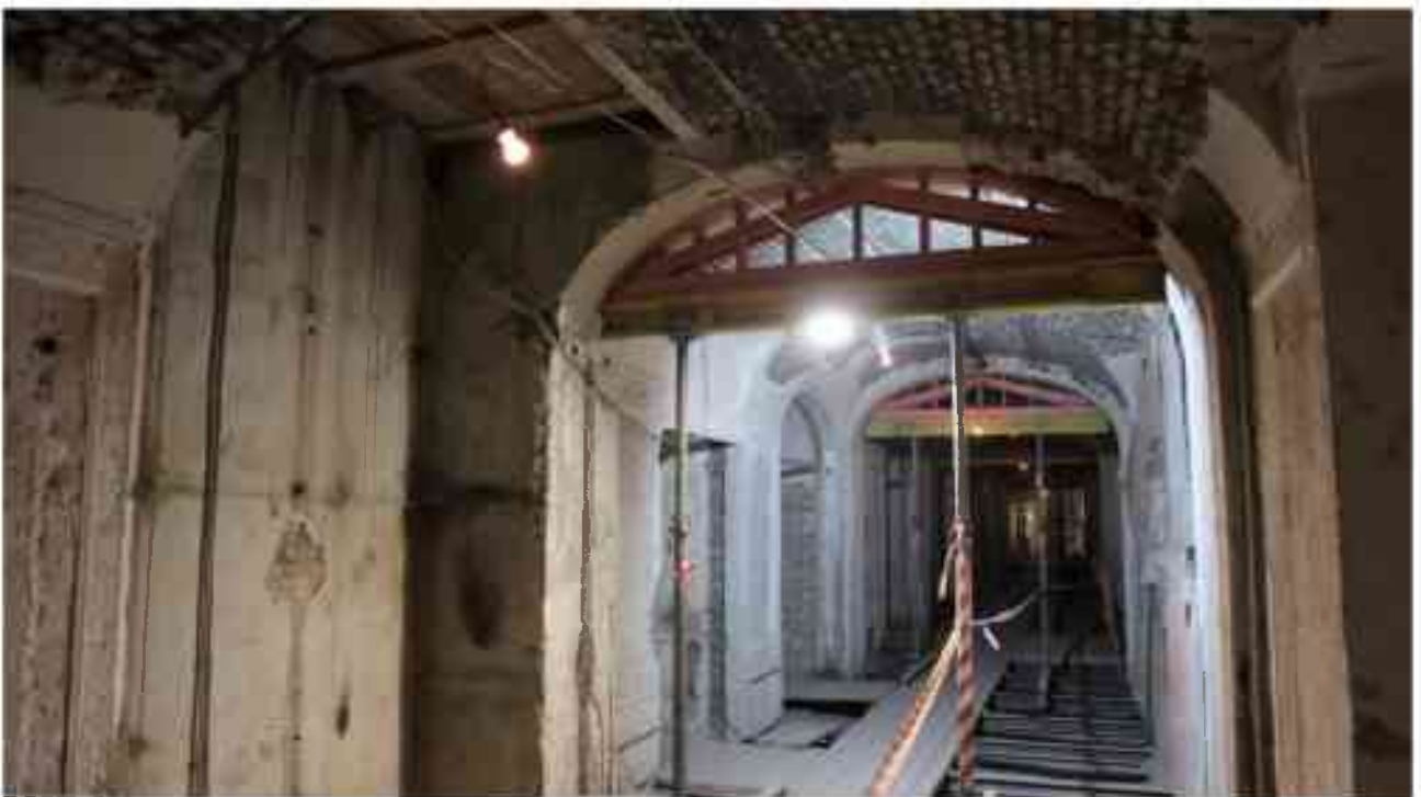
Фото 2.14. 2 этаж, помещение 22Н (64-67).
