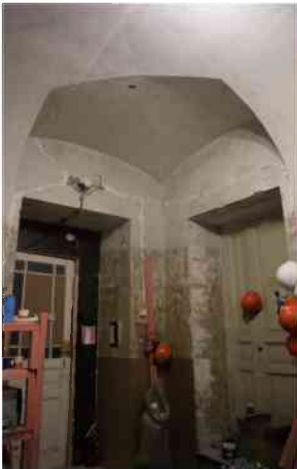
Фото 3.26. 3 этаж, помещение 28Н (22).
