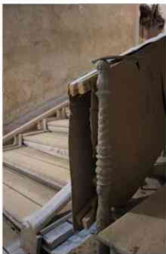
Фото 1.25. 1 этаж, лестница Л-1.
