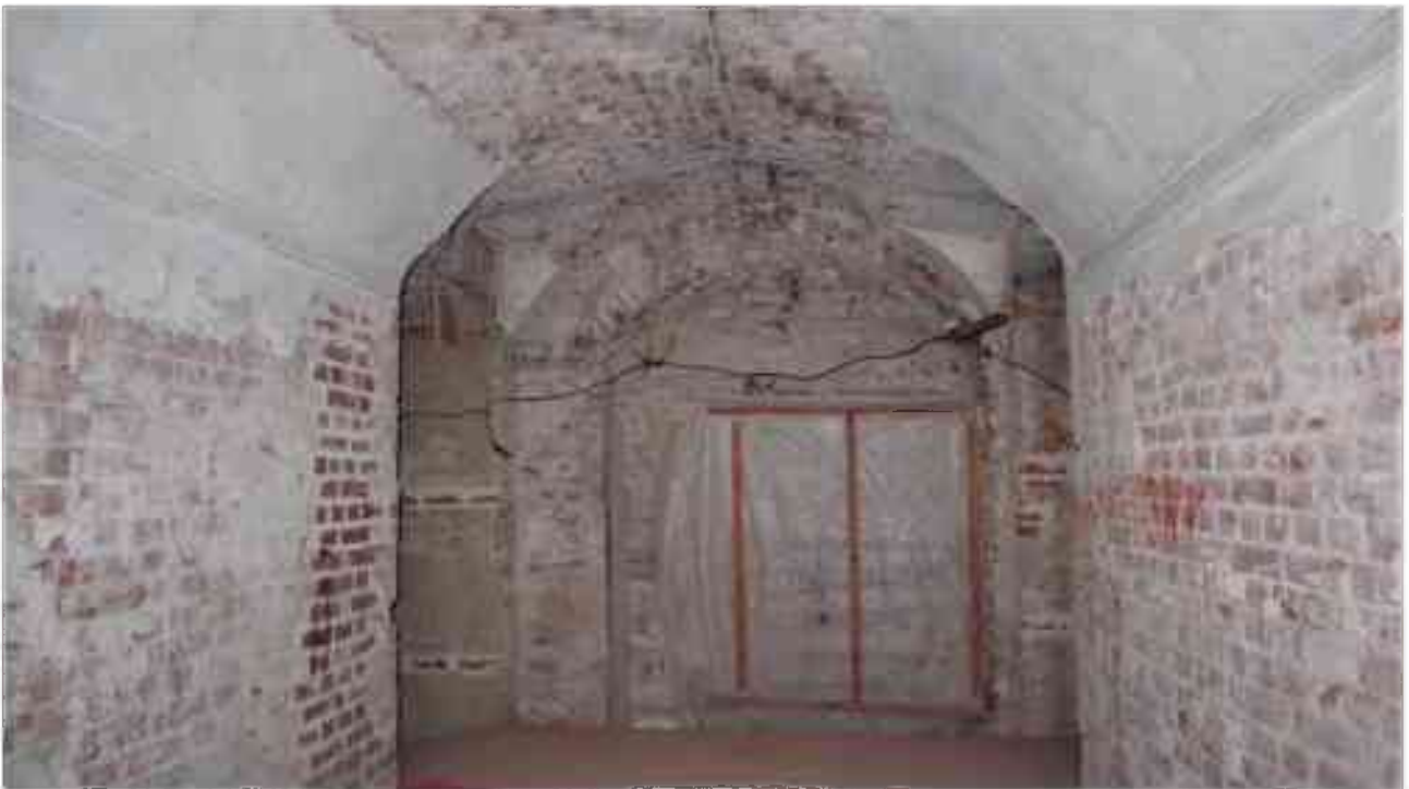
Фото 5.29. 5 этаж, помещение 35Н (20, 22).
