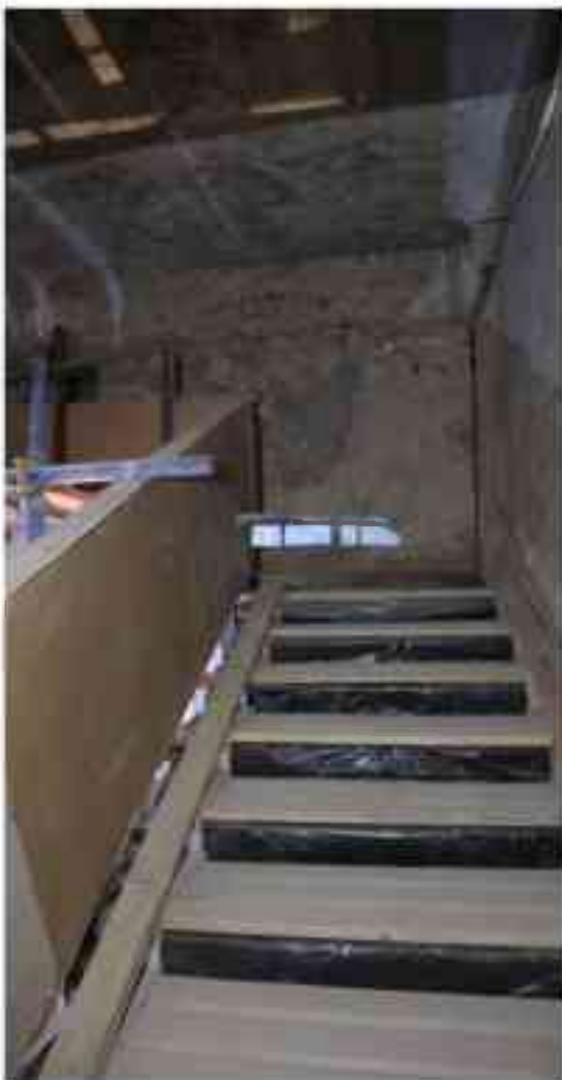
Фото 5.47. 5 этаж, лестница Л-7.
