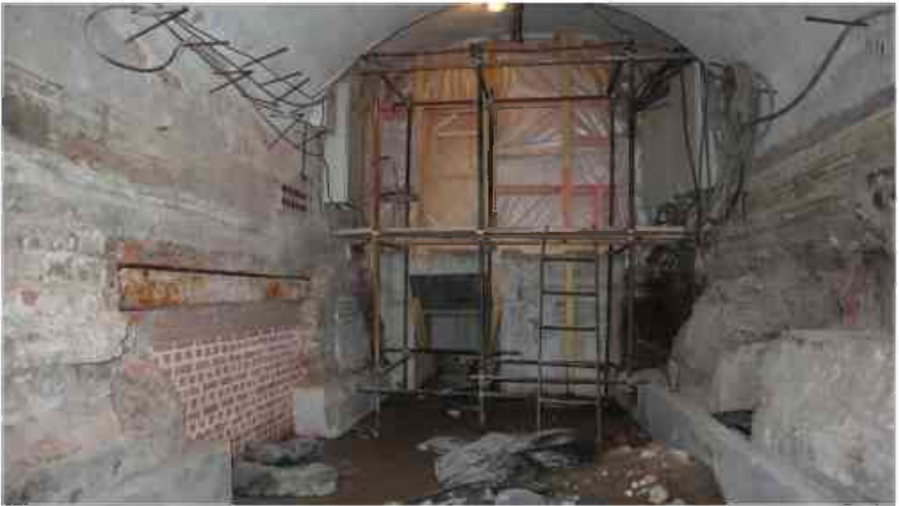
Фото п.312. Подвал, помещение 9Н (1).
