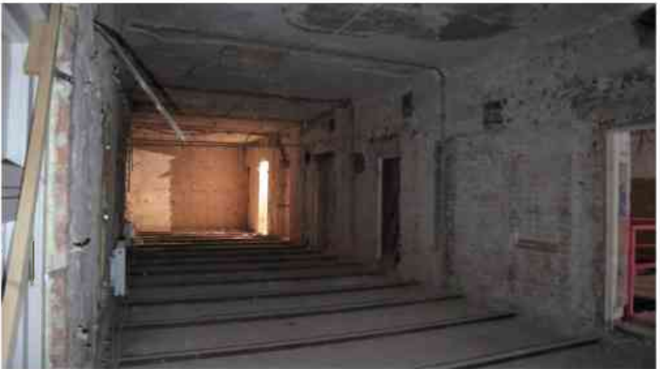
Фото 3.158. 3 этаж, помещение 23Н (1-6).
