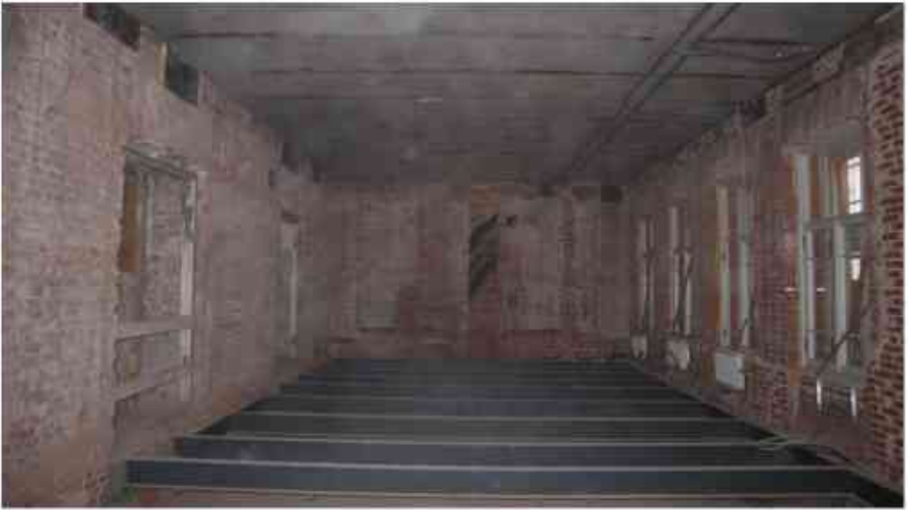
Фото 3.7. 3 этаж, помещение 28Н (44-47).
