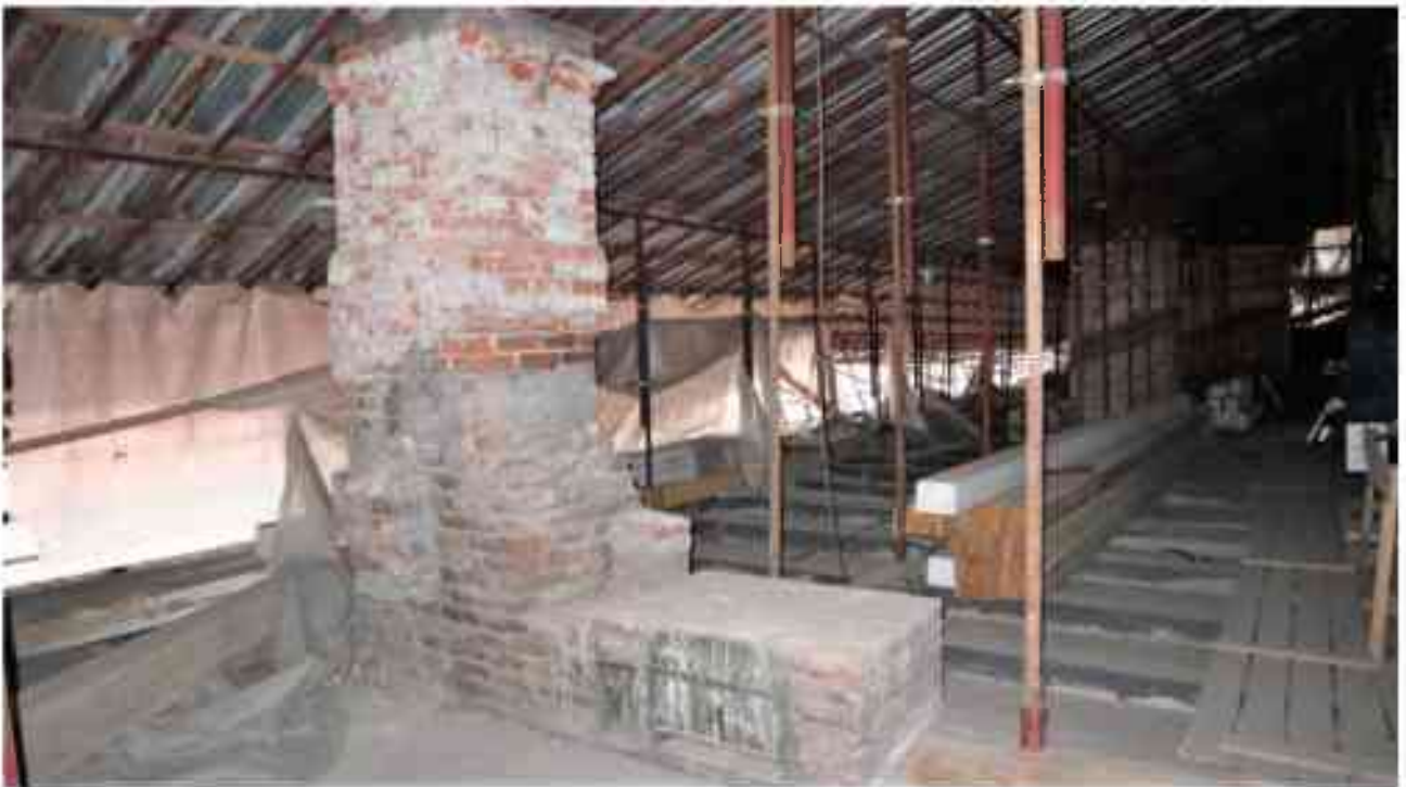
Фото 6.39. 6 этаж, чердачное помещение.
