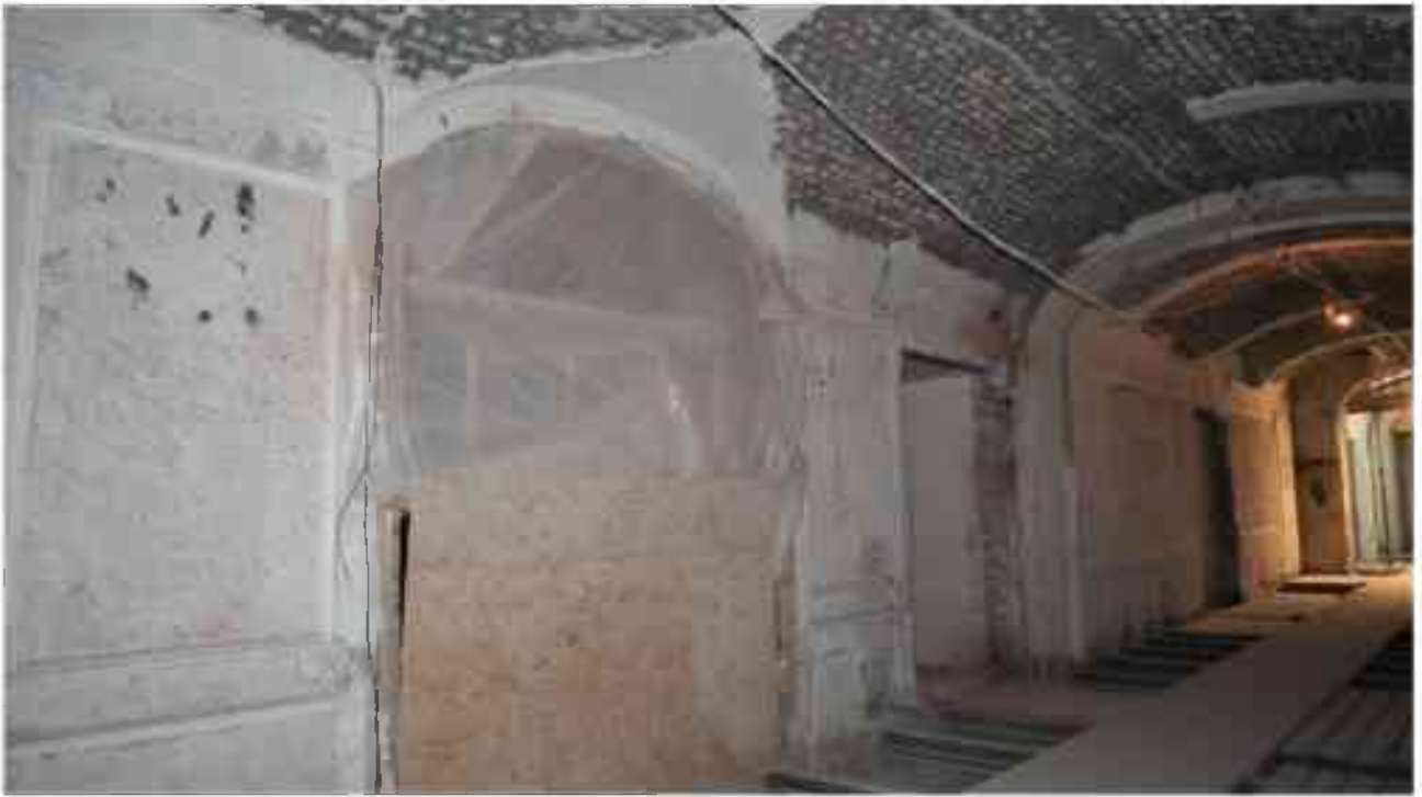
Фото 2.7. 2 этаж, помещение 22Н (66-67).
