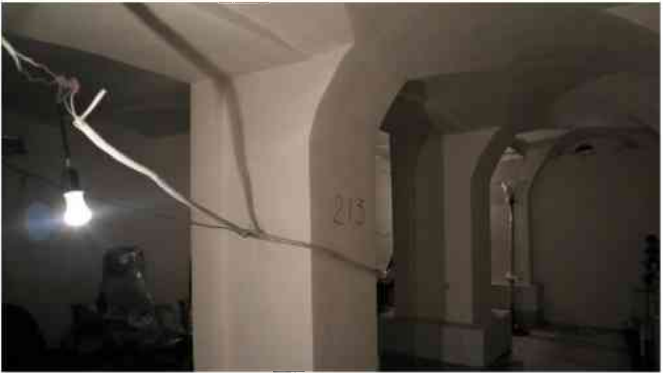
Фото п.137. Подвал, помещение 9Н (18, 26).
