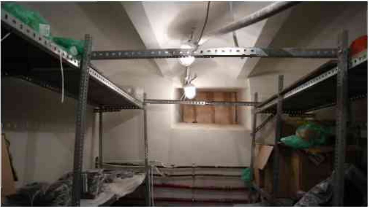
Фото п.116. Подвал, помещение 4Н (10).
