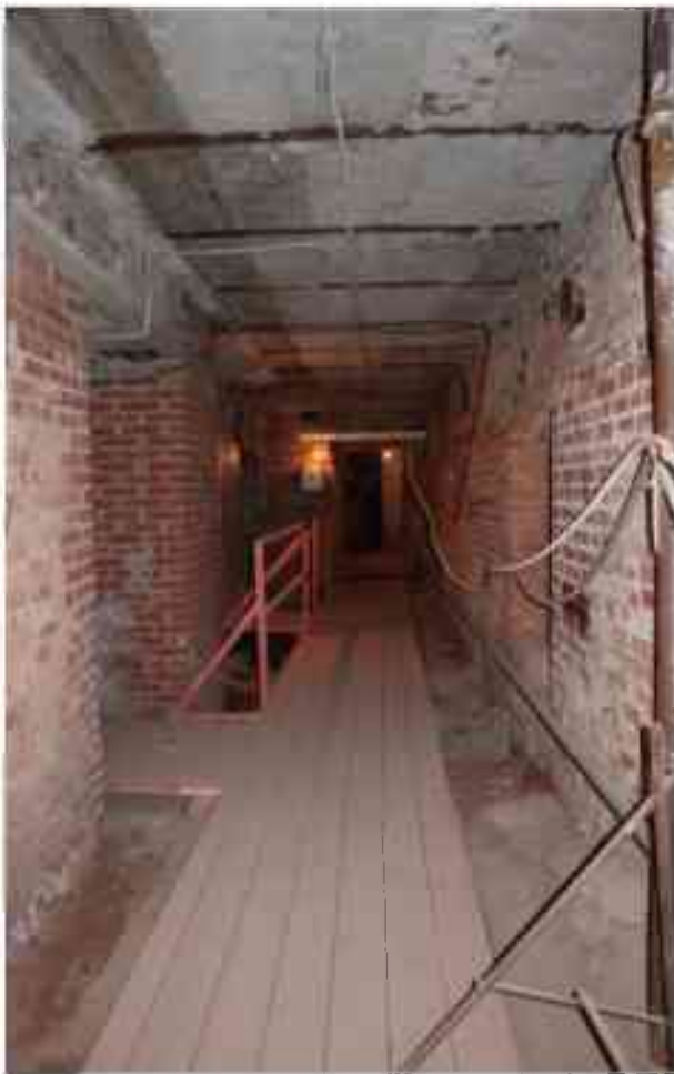
Фото п.16. Подвал, помещение 3Н (9).
