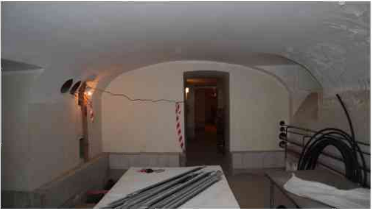
Фото п.129. Подвал, помещение 4Н (14-16).
