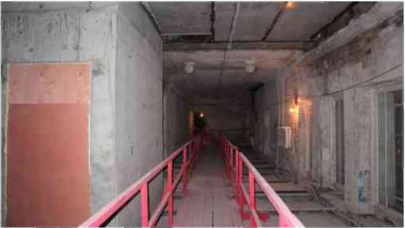
Фото 4.136. 4 этаж, помещение 30Н (1).
