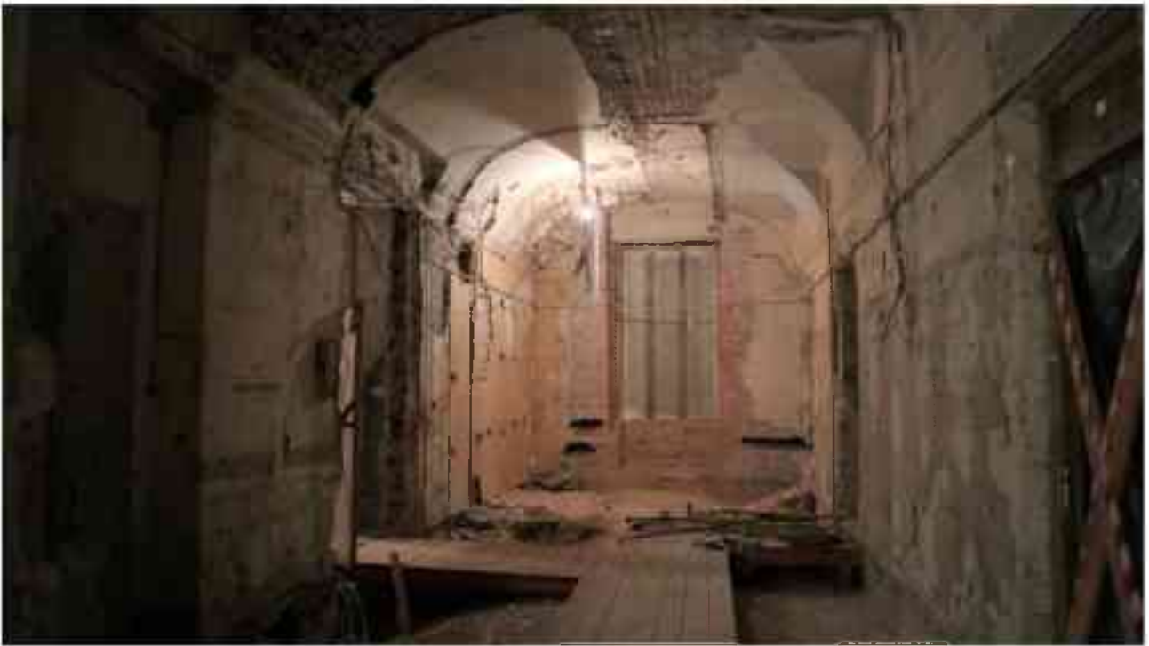
Фото 2.205. 2 этаж, помещение 22Н (10).
