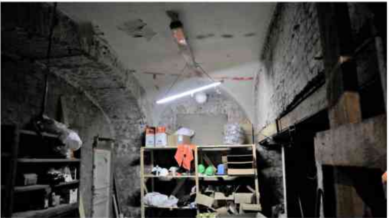
Фото 1.37. 1 этаж, помещение 14Н (7).
