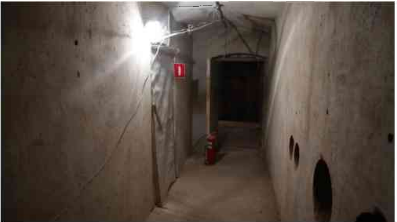
Фото п.8. Подвал, помещение 2Н (1).
