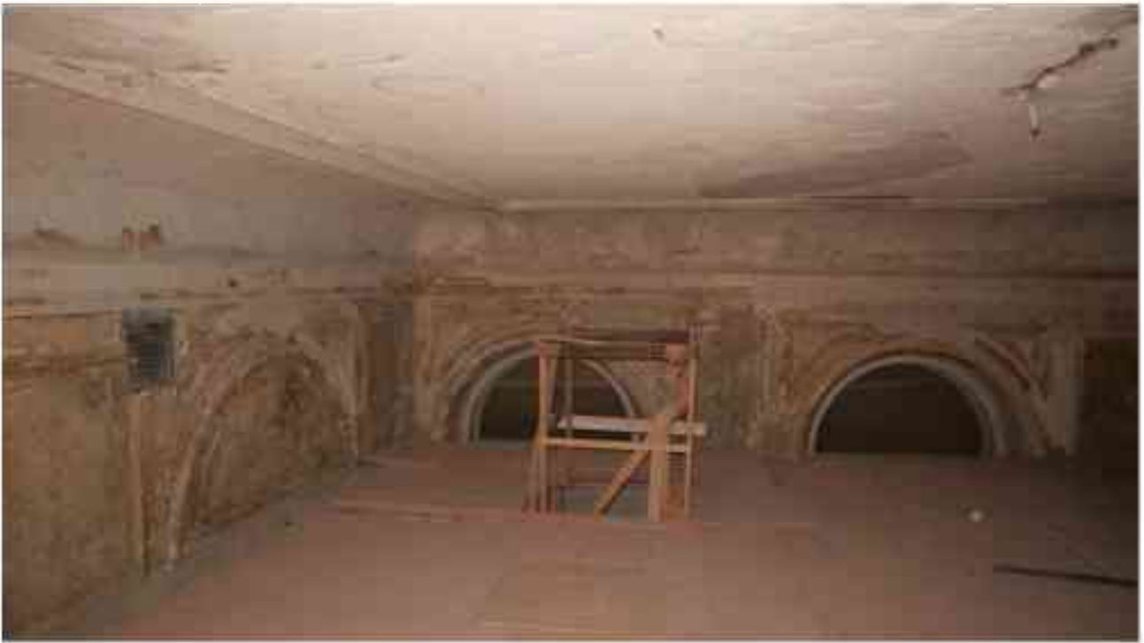
Фото 2.137. 2 этаж, помещение 22Н (18).*
