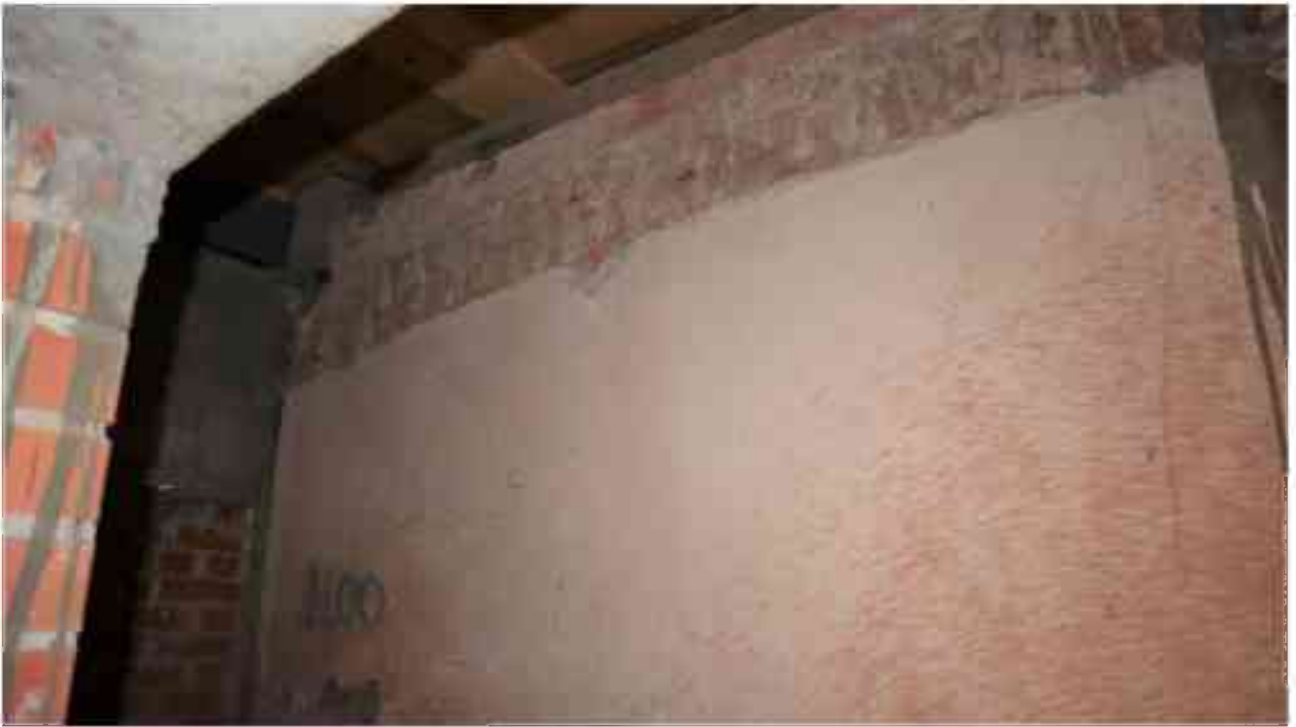
Фото п.172. Подвал, помещение 9Н (9).
