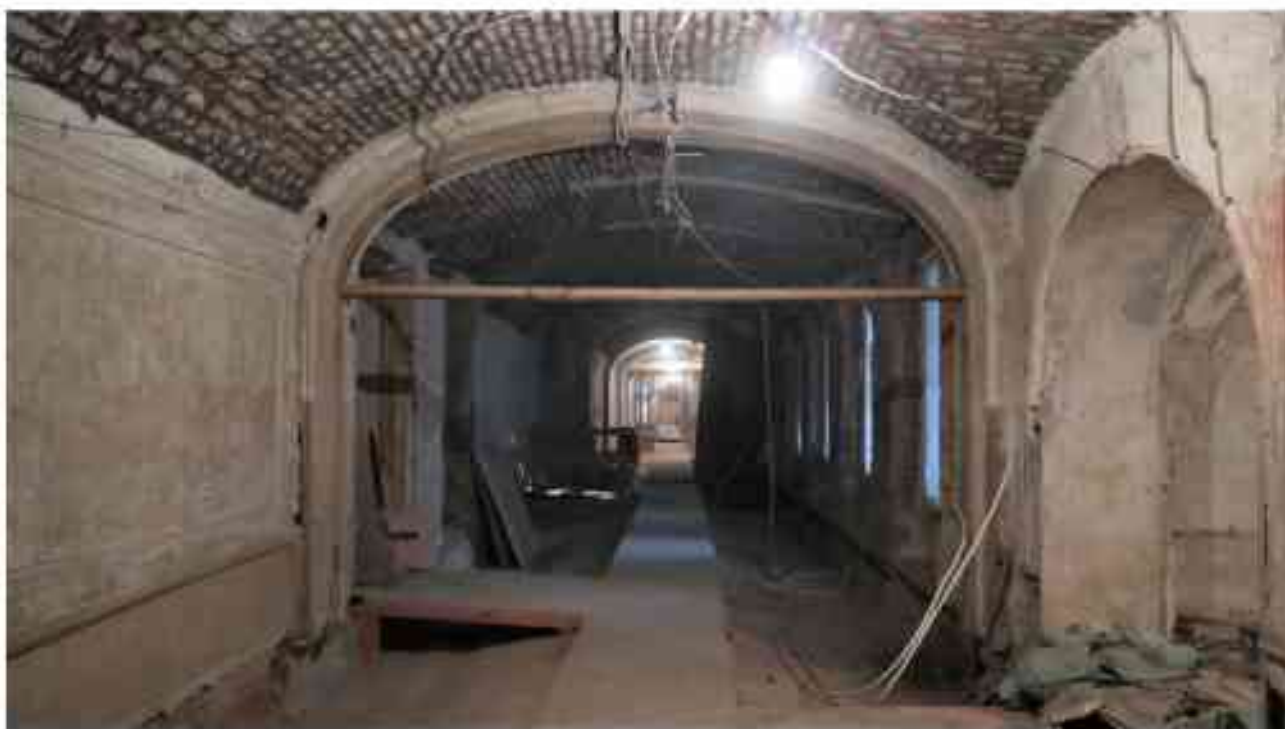
Фото 4.19. 4 этаж, помещение 33Н (30).
