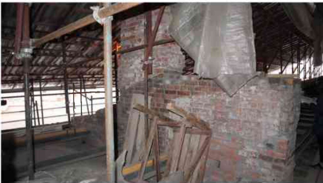
Фото 6.46. 6 этаж, чердачное помещение.
