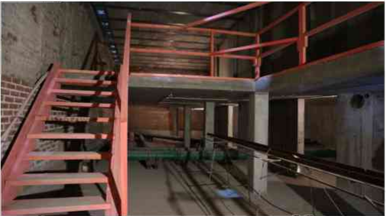
Фото п.37. Подвал, помещение 3Н (12).
