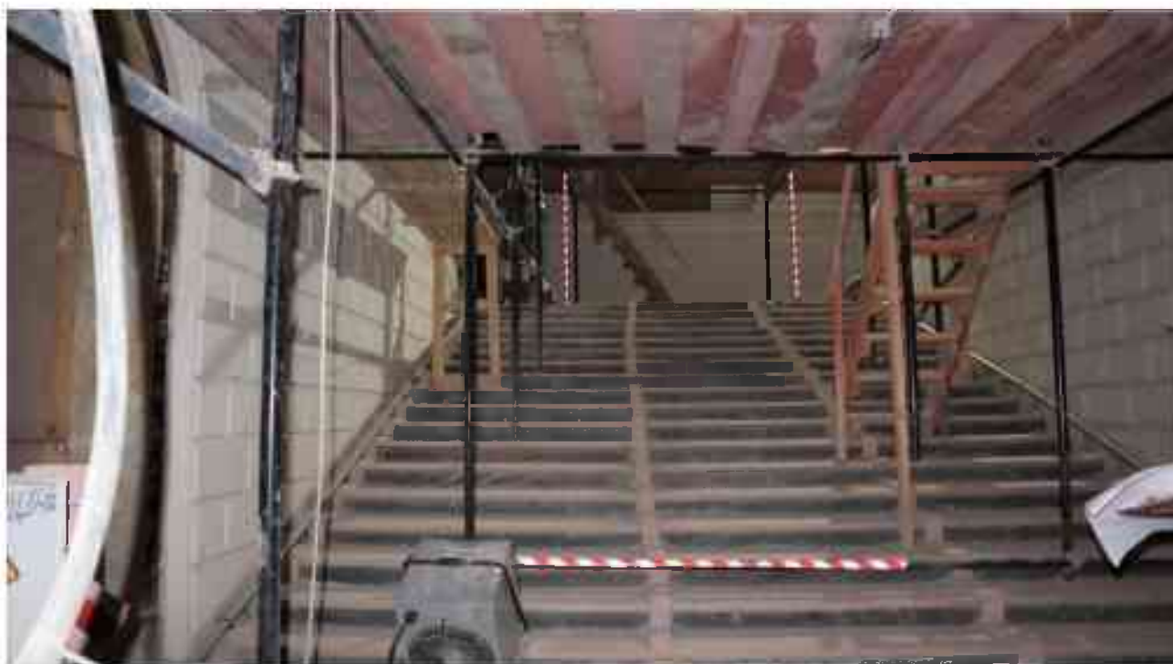
Фото 1.277. 1 этаж, лестница Л-11.
