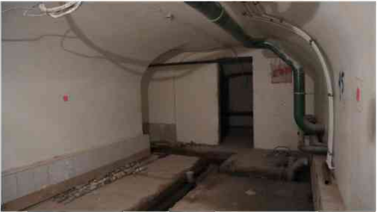
Фото п.247. Подвал, помещение 6Н (2).
