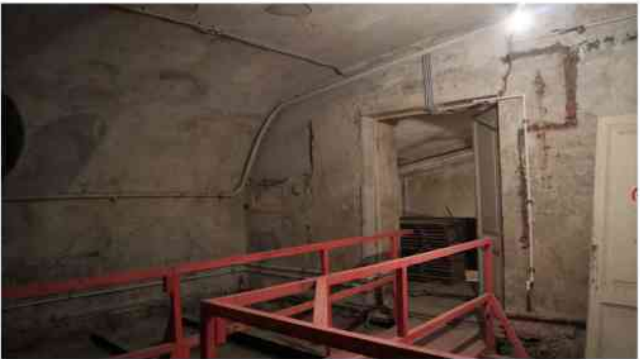
Фото 5.97. 5 этаж, помещение 35Н(2).
