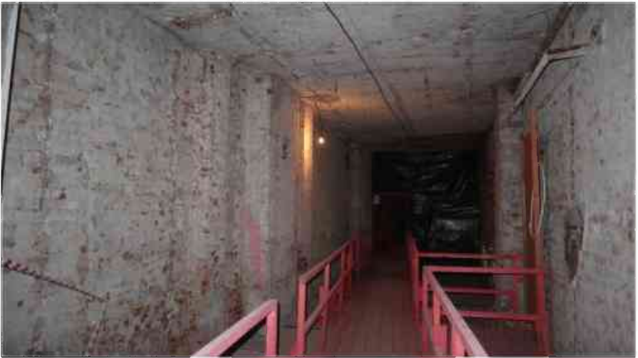
Фото 4.119. 4 этаж, коридор, помещение 29Н (3-4).
