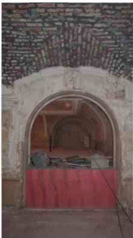
Фото 4.20. 4 этаж, помещение 33Н (30).
