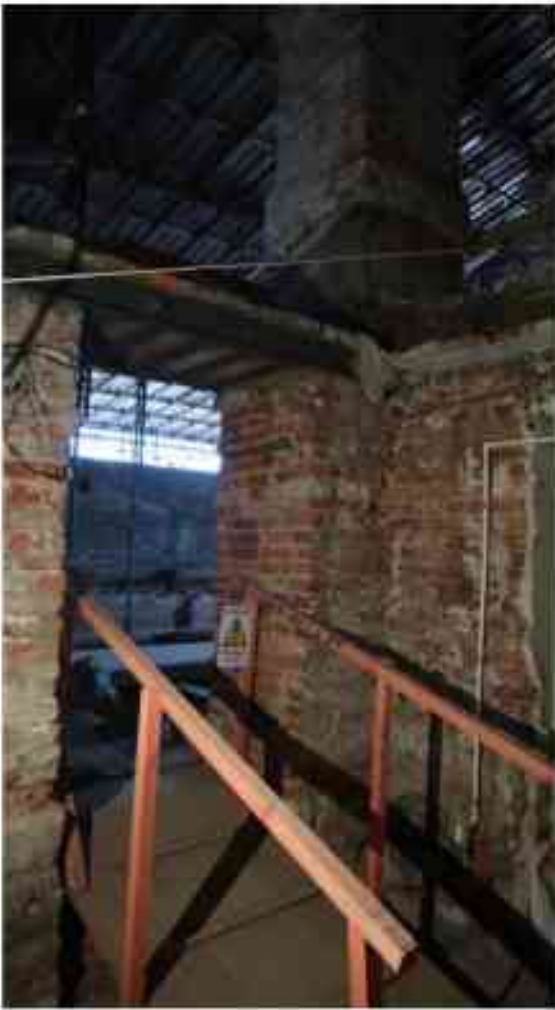
Фото 5.188. 5 этаж, коридор, помещения 34Н/37Н.
