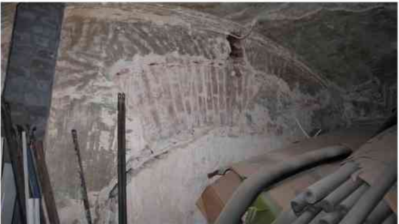
Фото 1.146. 1 этаж, помещение 31Н (11).
