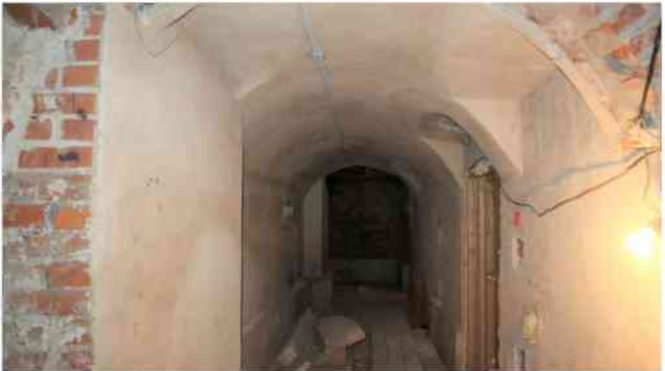
Фото п.219. Подвал, помещение 9Н (3).
