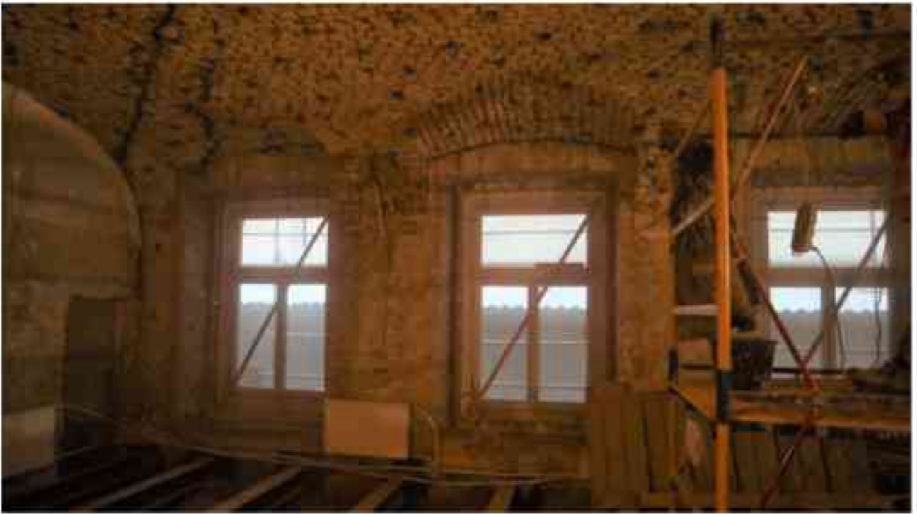
Фото 1.197. 1 этаж, помещение 11Н (1-3, 5).
