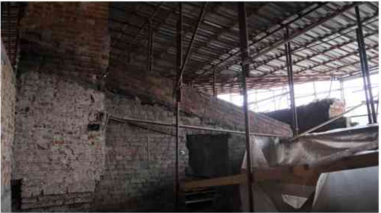
Фото 5.162. 5 этаж, чердачное помещение.
