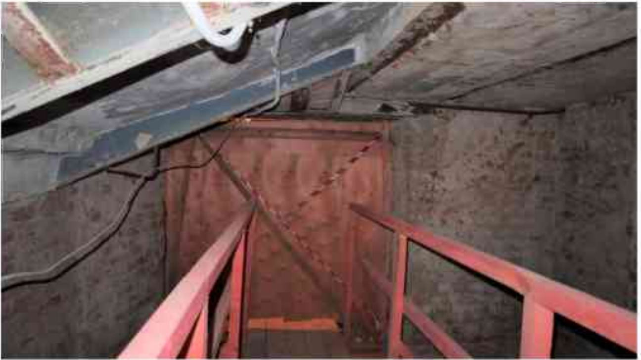
Фото п.342. Подвал, помещение 18Н (5).
