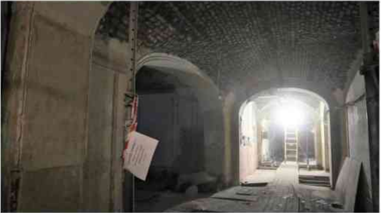
Фото 3.27. 3 этаж, помещение 28Н (27).
