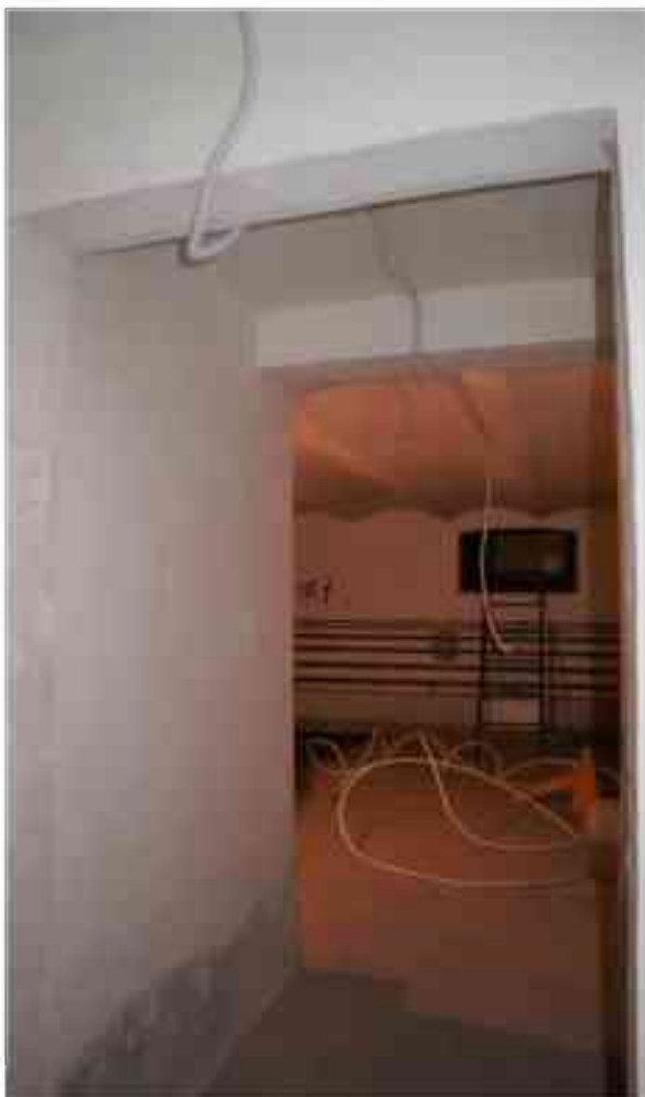
Фото п.259. Подвал, помещение 6Н (7).
