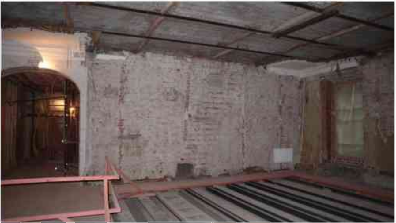
Фото 3.65. 3 этаж, помещение 28Н (5-10).
