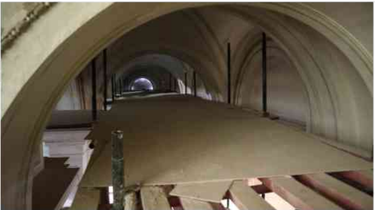
Фото 2.146. 2 этаж, помещение 22Н (19).*
