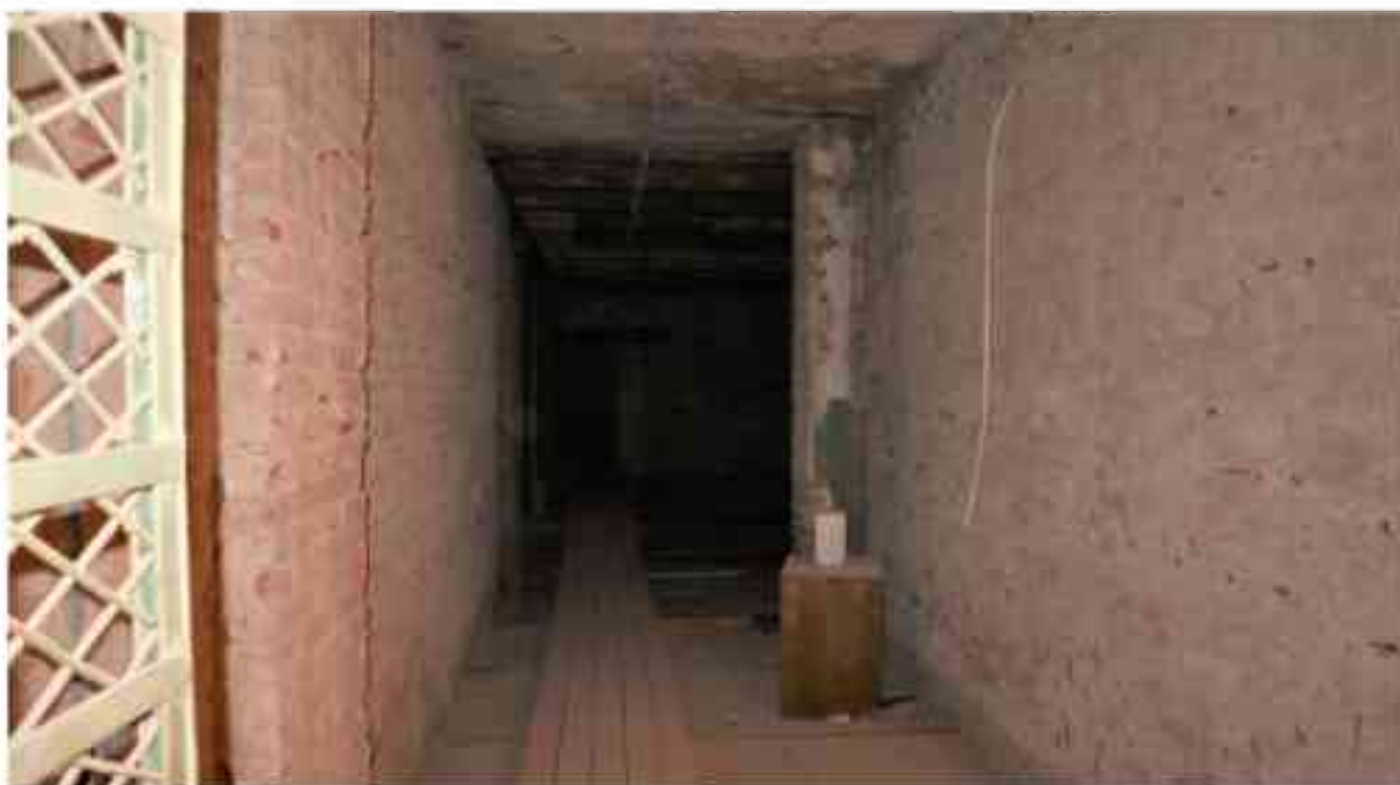
Фото 4.184. 4 этаж, помещение 42Н* (1, 3).
