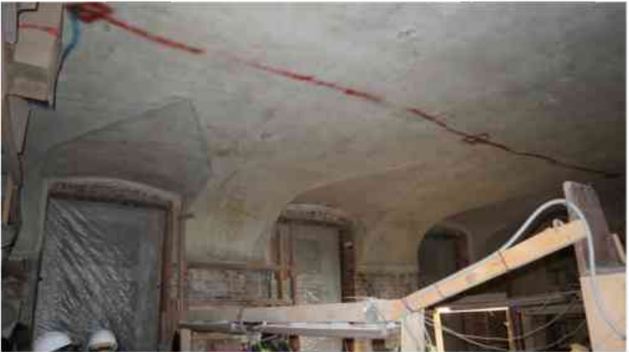
Фото 2.36. 2 этаж, помещение 22Н (52).
