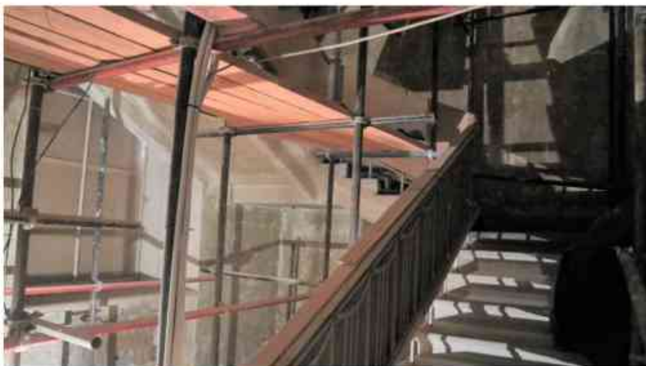
Фото 2.195. 2 этаж, лестница Л-7.
