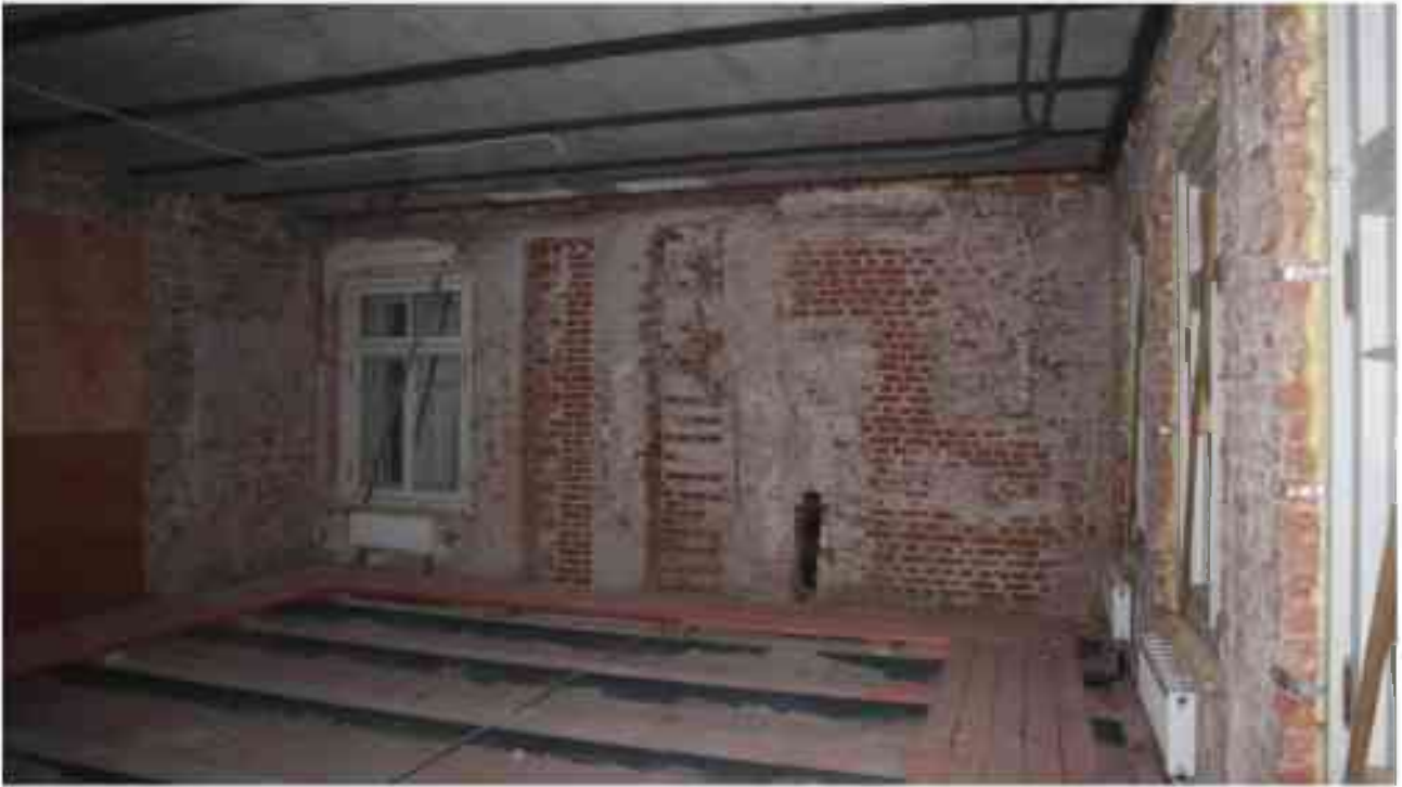
Фото 4.75. 4 этаж, помещение 33Н (16-20).
