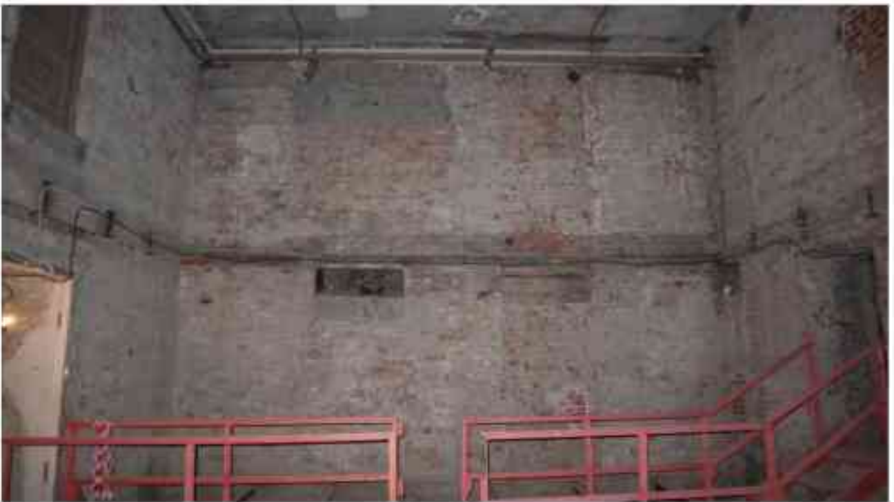
Фото 4.124. 4 этаж, помещение 29Н (5, 10-11).
