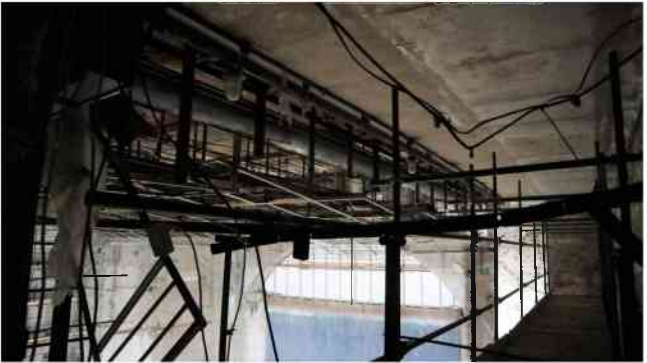
Фото 5.104. 5 этаж, помещение 35Н(3).
