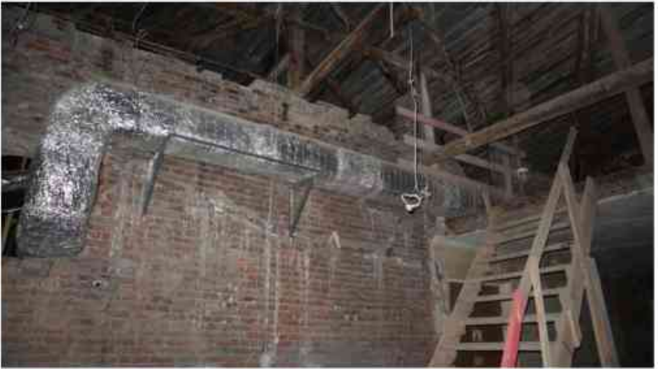
Фото 6.66. 6 этаж, чердачное помещение.
