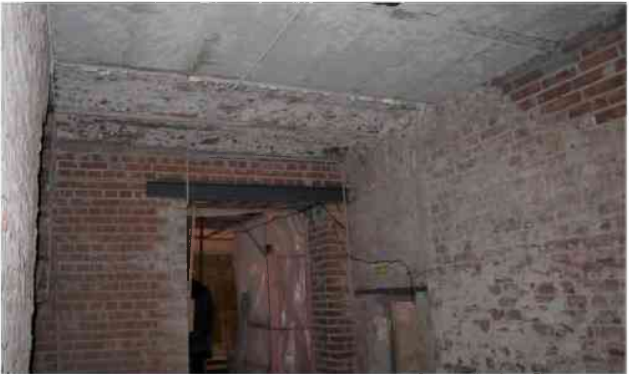
Фото 5.89. 5 этаж, помещение 34Н(12).
