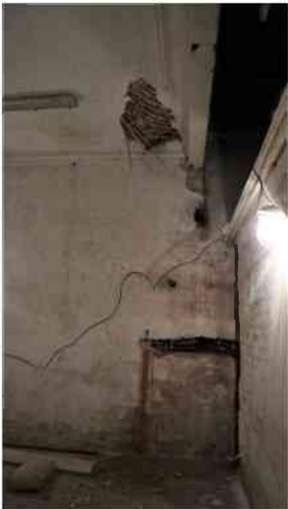
Фото 3.173. 3 этаж, помещение 24Н (1).
