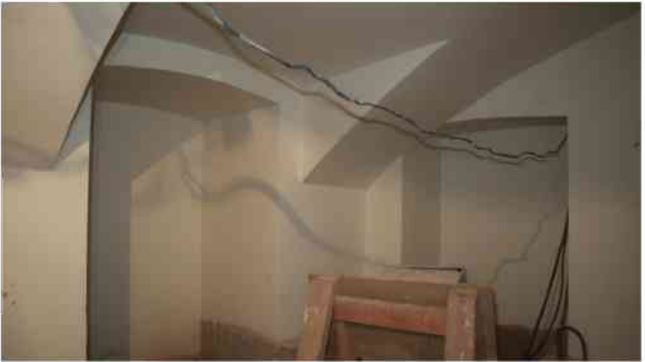
Фото п.216. Подвал, помещение 9Н (4).
