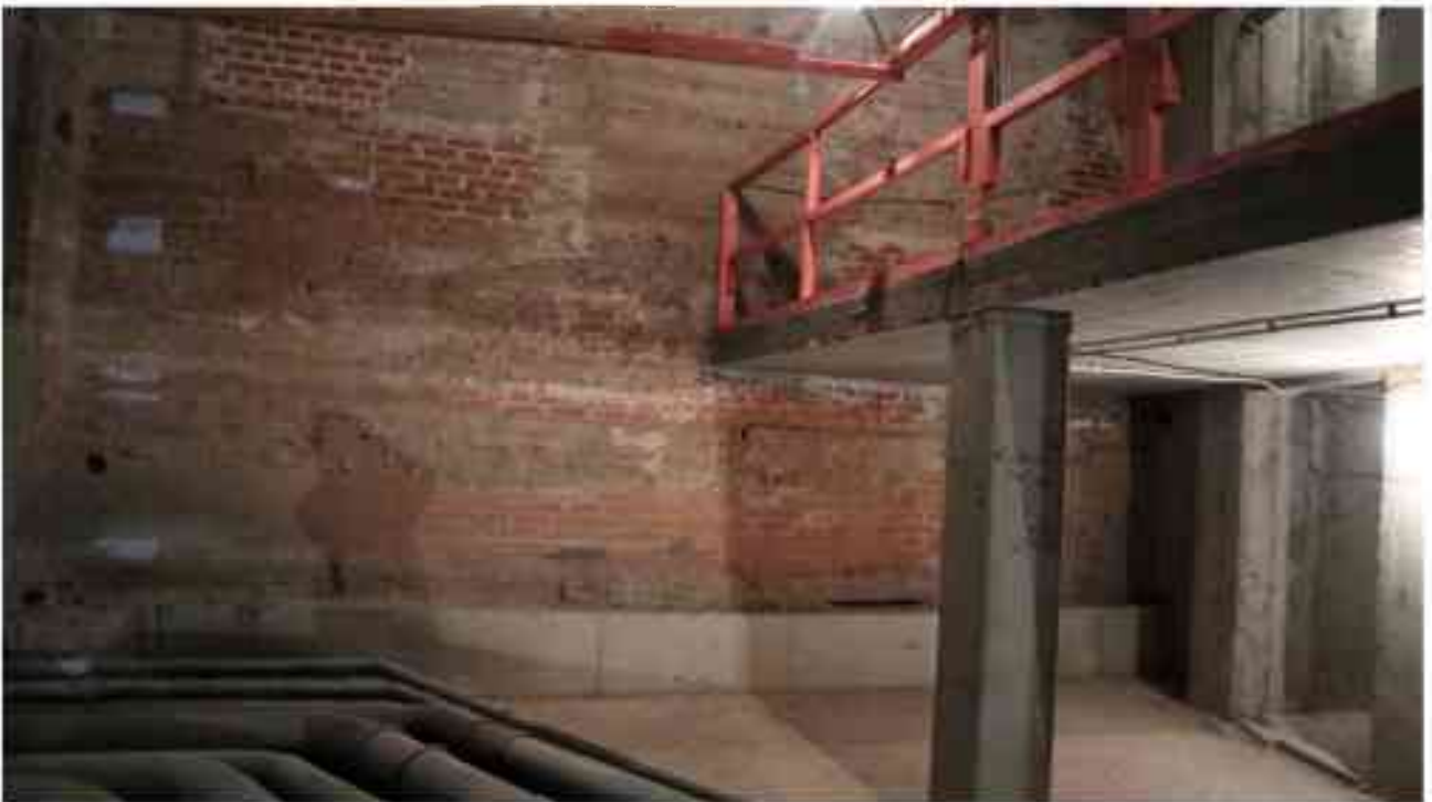
Фото п.39. Подвал, помещение 3Н (12).
