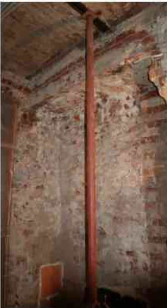
Фото 5.33. 5 этаж, помещение 35Н (28).
