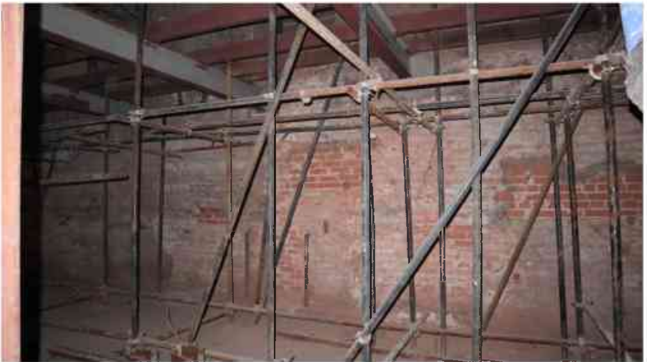
Фото 1.187. 1 этаж, помещение 17Н (1).
