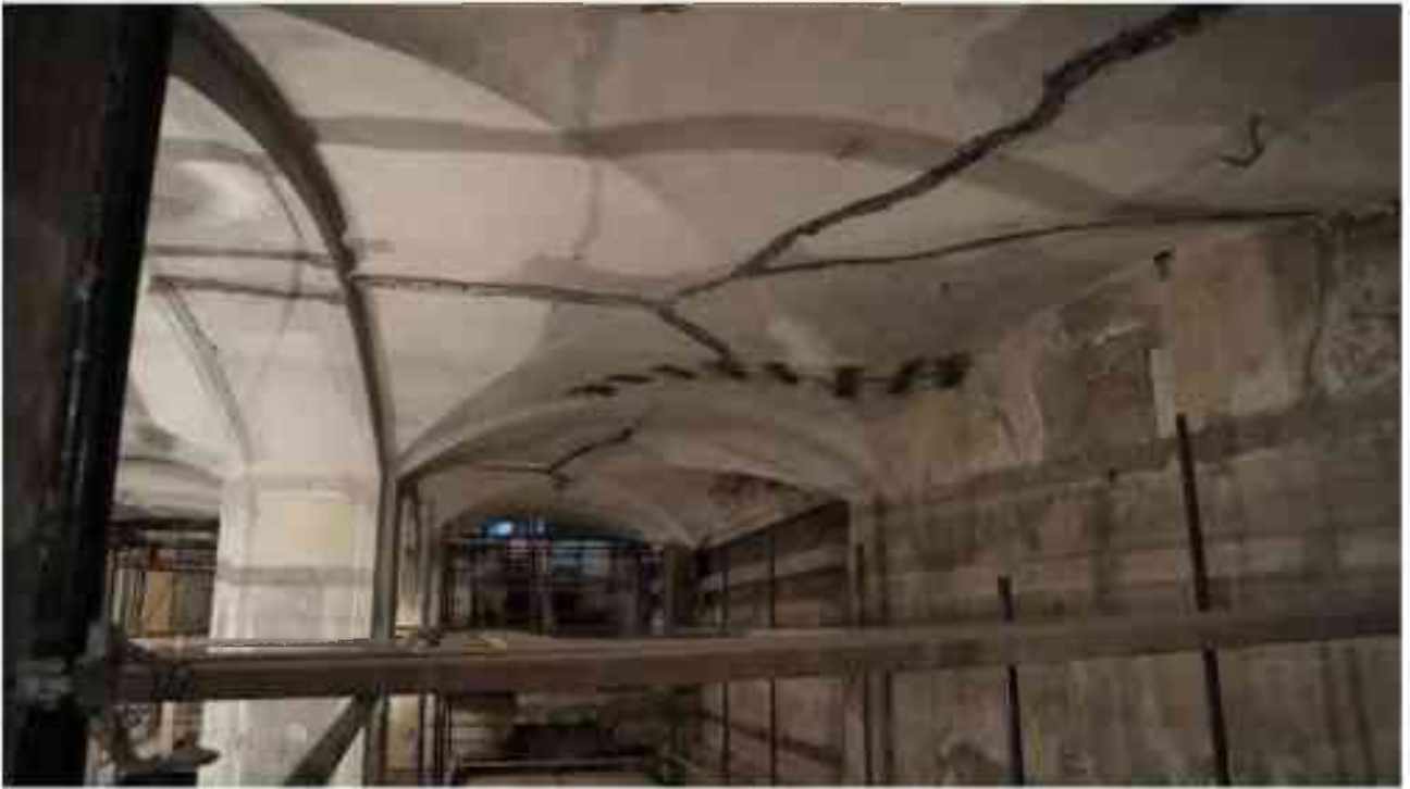
Фото 1.302. 1 этаж, помещение 13Н (3).
