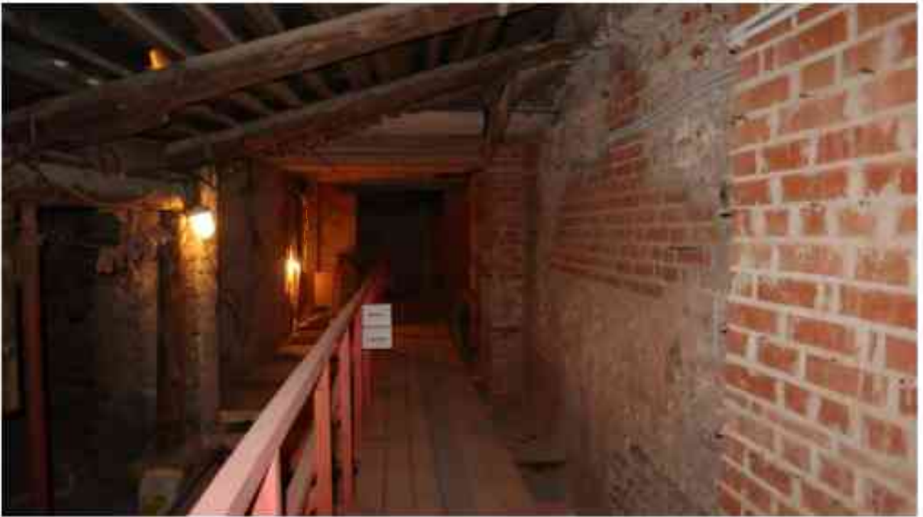
Фото 6.12. 6 этаж, чердачное помещение.
