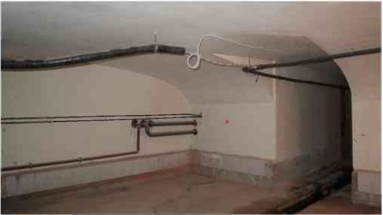
Фото п.256. Подвал, помещение 6Н (3).
