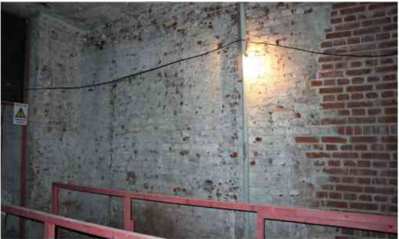
Фото 4.114. 4 этаж, коридор, помещение 29Н (1-2).
