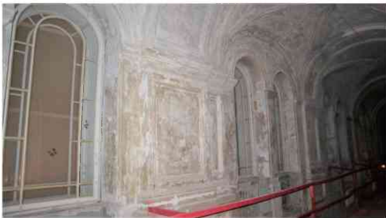
Фото 4.158. 4 этаж, помещение 30Н (4).
