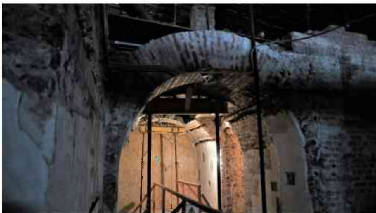
Фото 5.3. 5 этаж, помещение 37Н (1).
