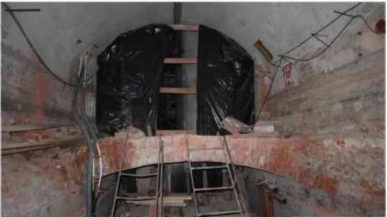
Фото п.315. Подвал, помещение 9Н (1).
