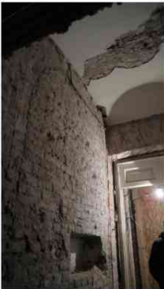
Фото 3.101. 3 этаж, помещение 28Н (4).
