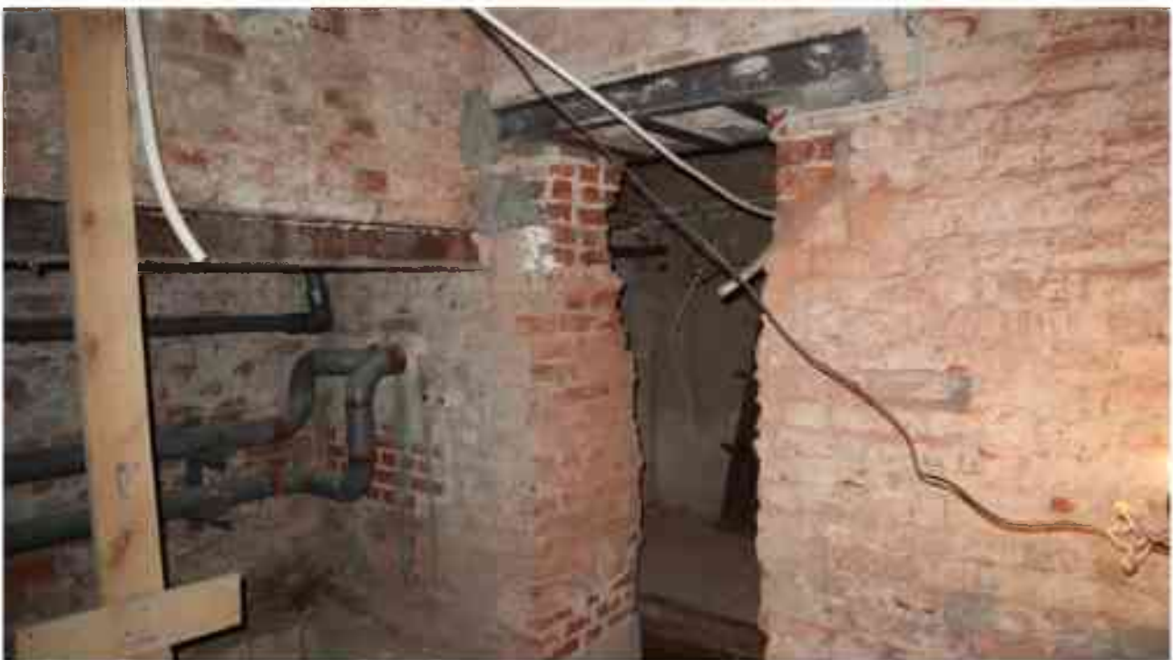
Фото п.67. Подвал, лестница Л-3.
