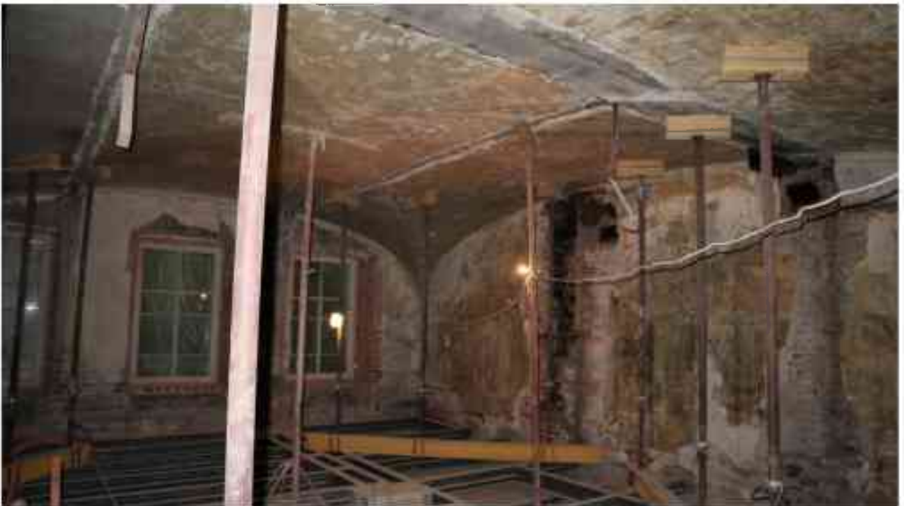
Фото 1.153. 1 этаж, помещение 31Н (16-17), 10Н (4-6).
