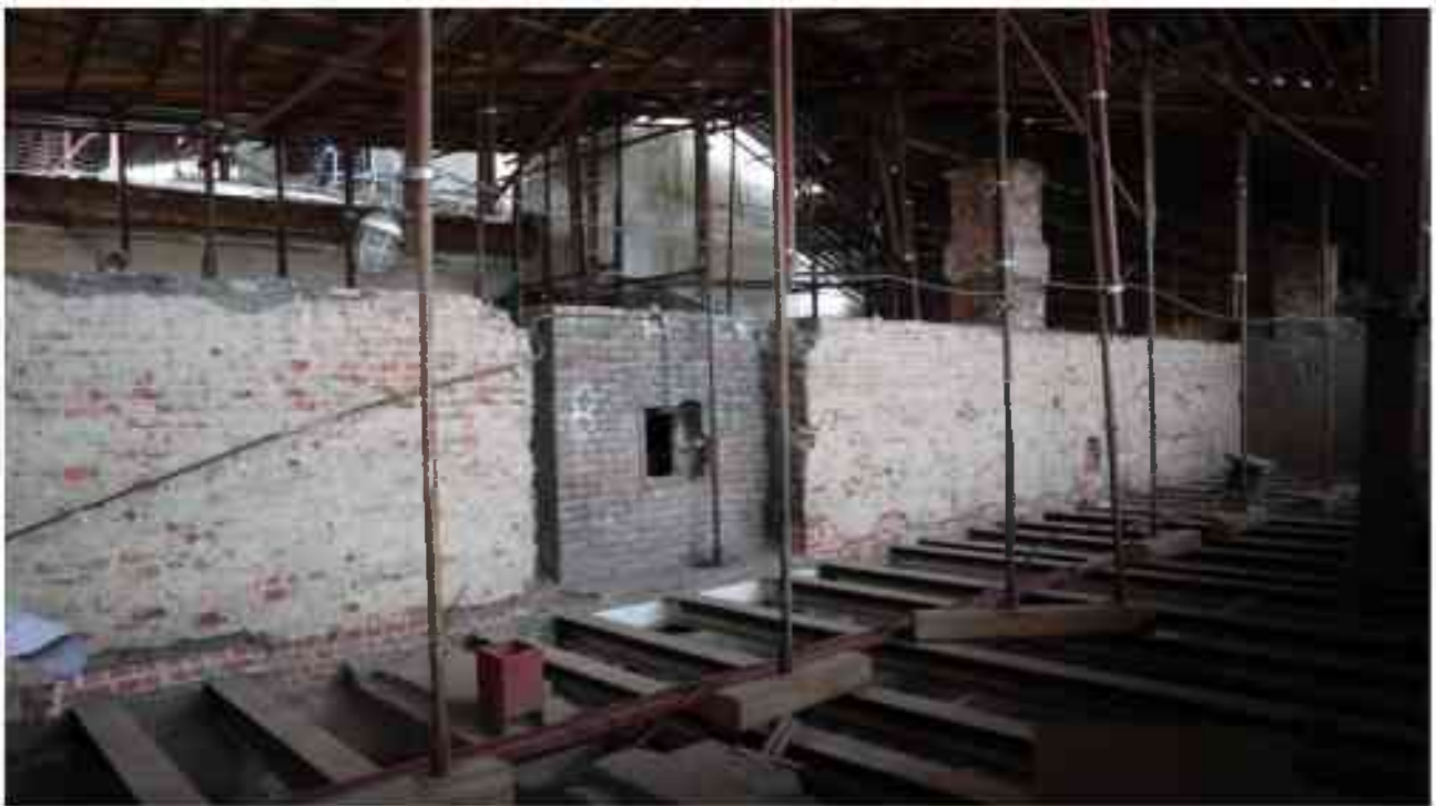
Фото 5.171. 5 этаж, чердачное помещение.
