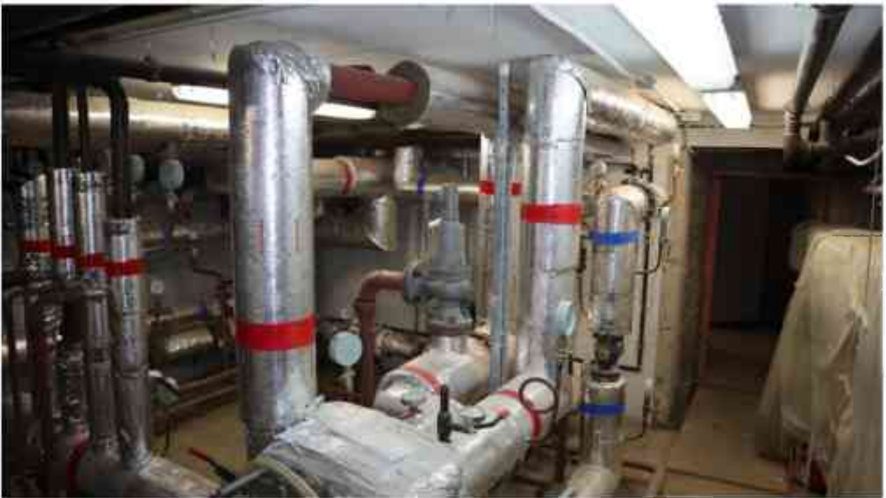
Фото п.327. Подвал, помещение 18Н (10-12).
