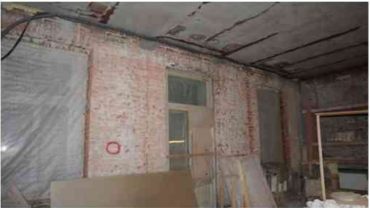
Фото 3.8. 3 этаж, помещение 28Н (26).
