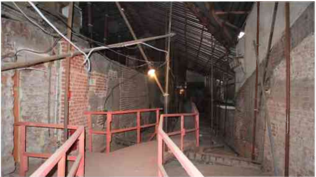
Фото 5.123. 5 этаж, коридор, помещения 34Н/37Н.
