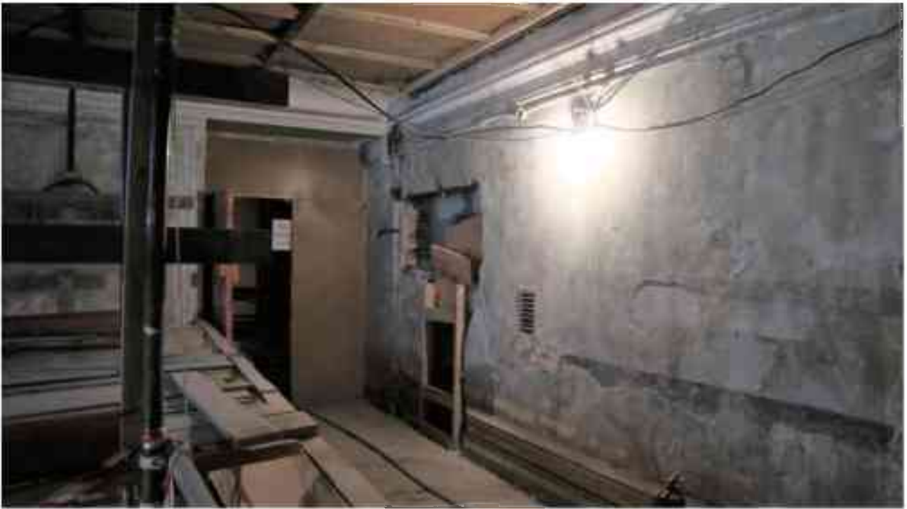
Фото 5.86. 5 этаж, лестница Л-13.
