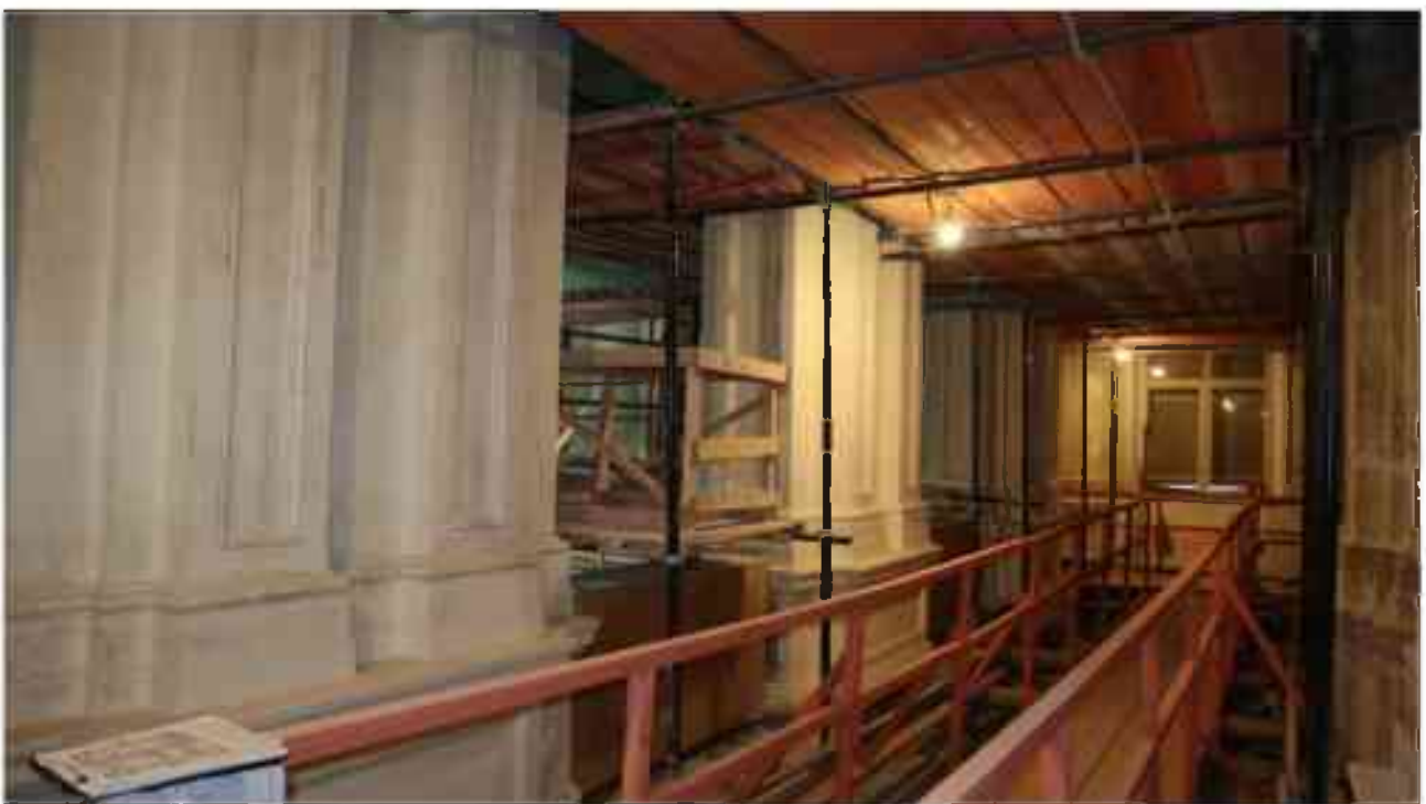
Фото 2.123. 2 этаж, помещение 22Н (19).
