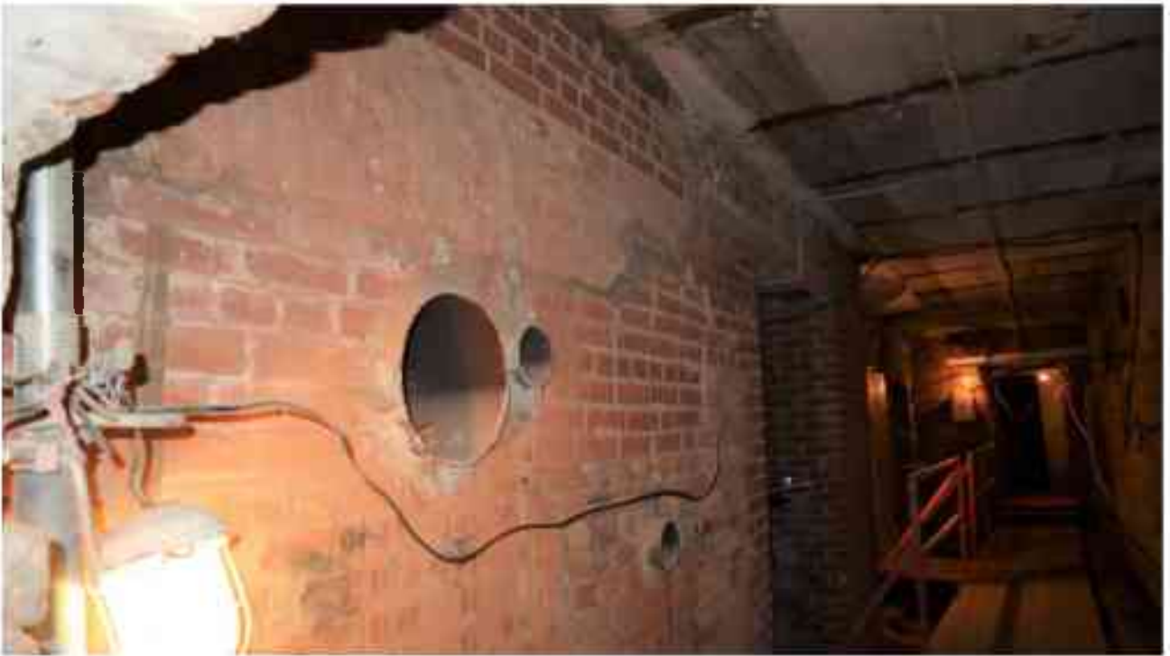
Фото п.17. Подвал, помещение 3Н (9).
