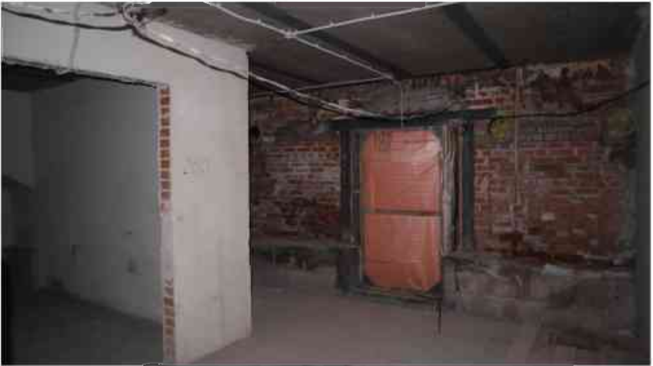
Фото п.233. Подвал, помещение 9Н (23-24).
