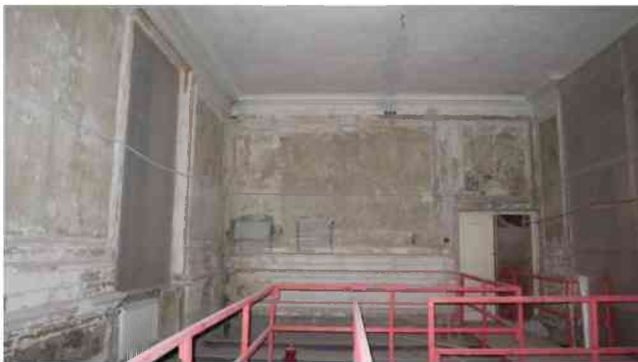
Фото .2.170 2 этаж, помещение 22Н (17).
