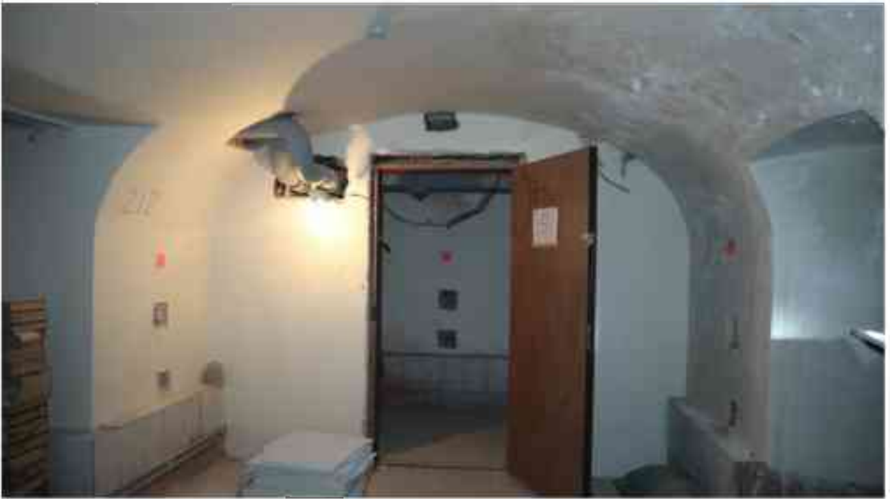
Фото п.152. Подвал, помещение 9Н (17).
