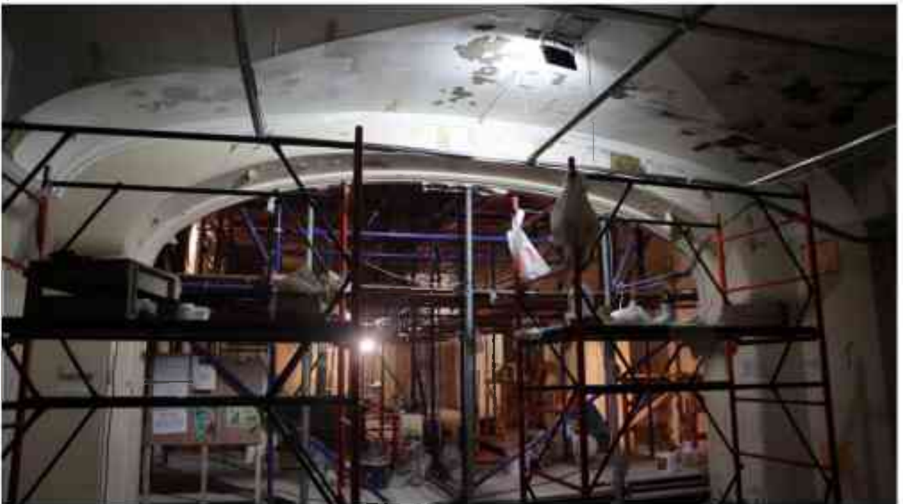
Фото 3.41. 3 этаж, помещение 28Н (18).
