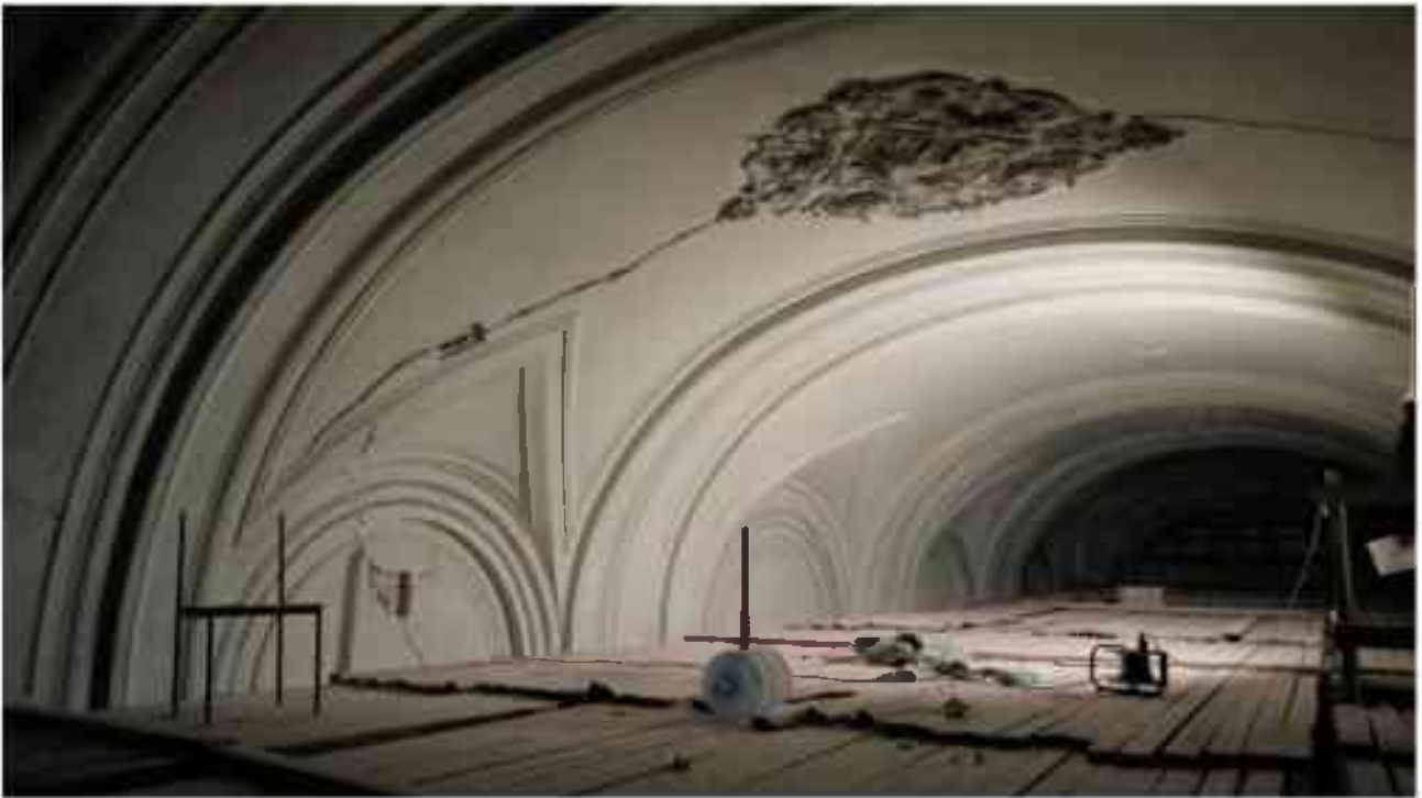
Фото 2.147. 2 этаж, помещение 22Н (19).*
