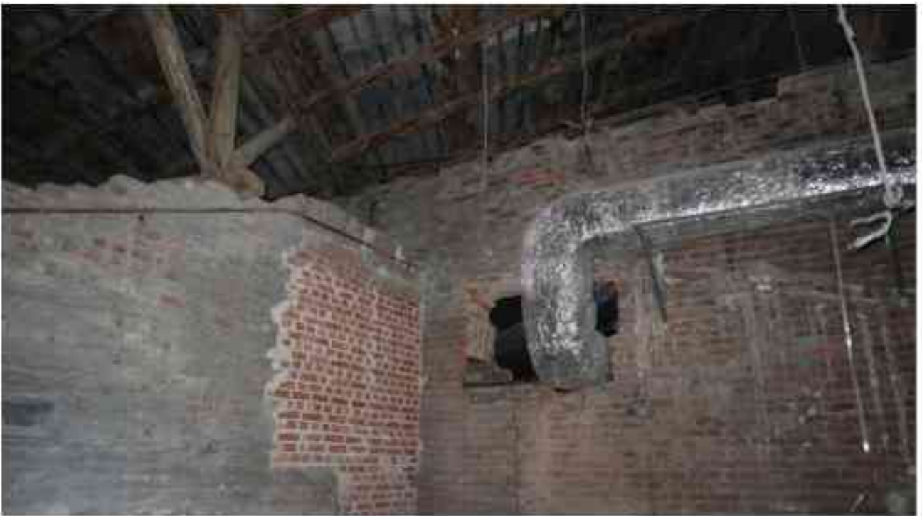
Фото 6.67. 6 этаж, чердачное помещение.
