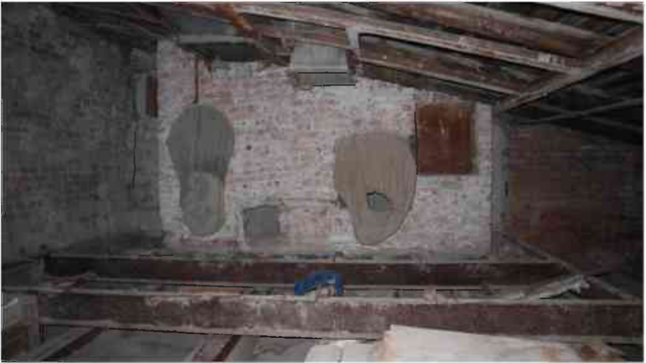
Фото 6.14. 6 этаж, чердачное помещение.
