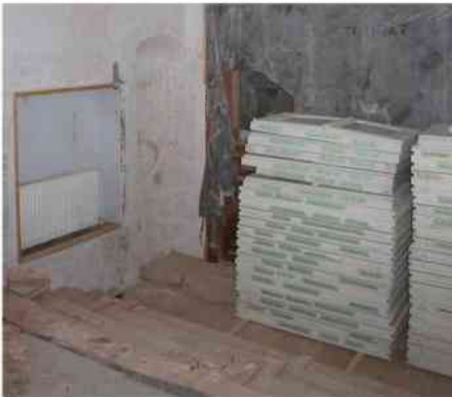
Фото 1.101. 1 этаж, лестница Л-4.
