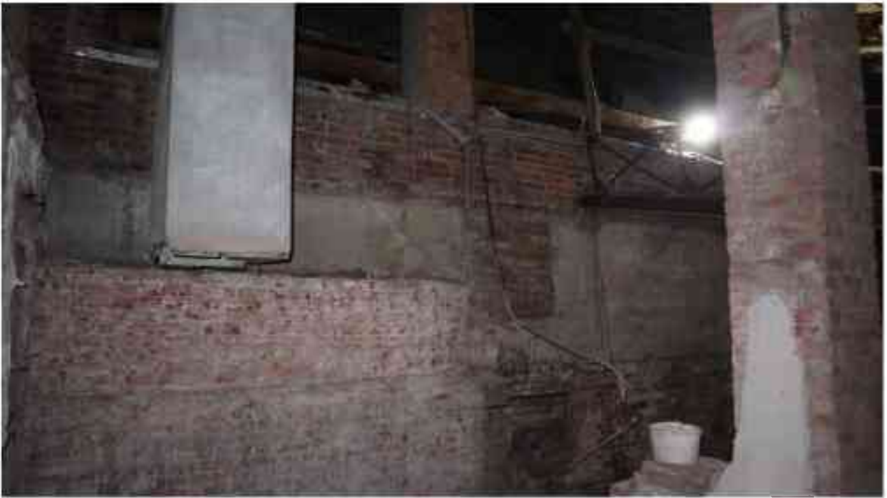
Фото 5.78. 5 этаж, чердачное помещение, купол.
