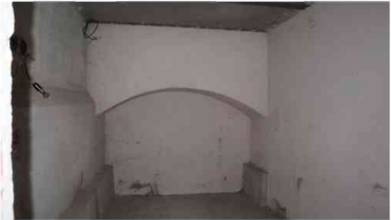
Фото п.234. Подвал, помещение 9Н (24).
