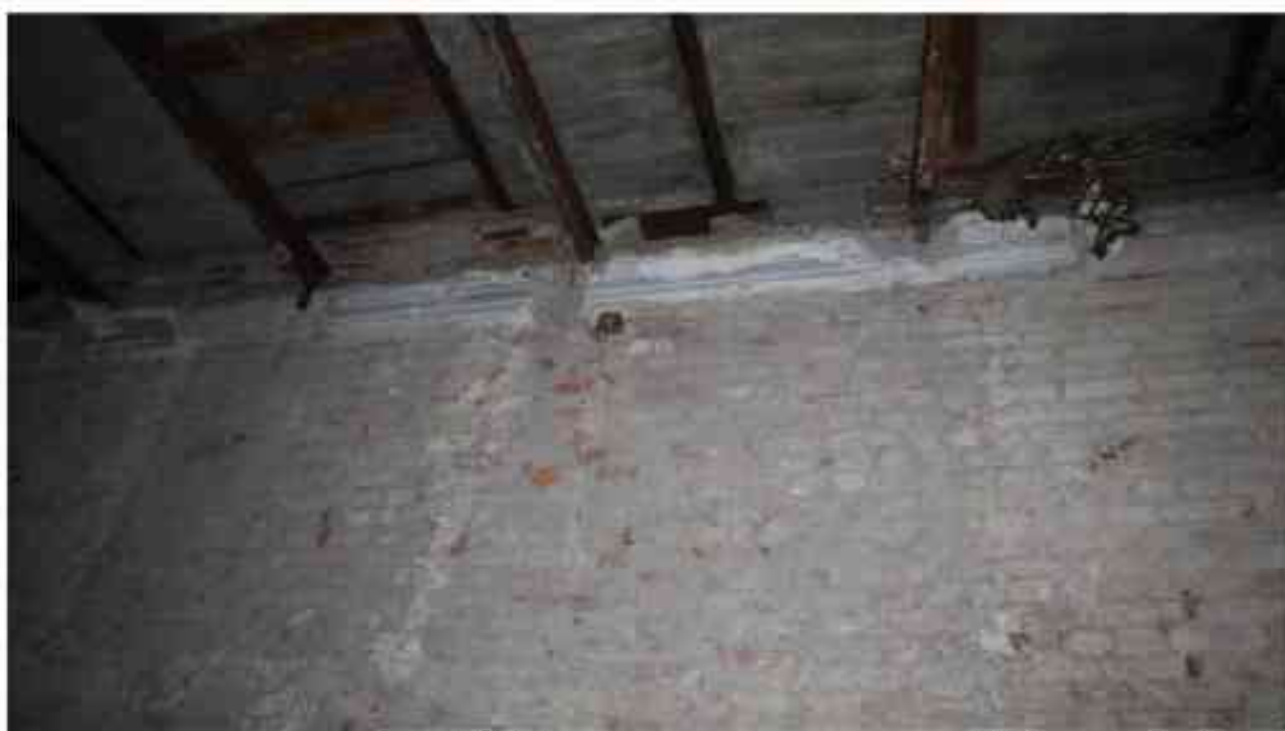
Фото 5.66. 5 этаж, помещение 35Н (4-6).
