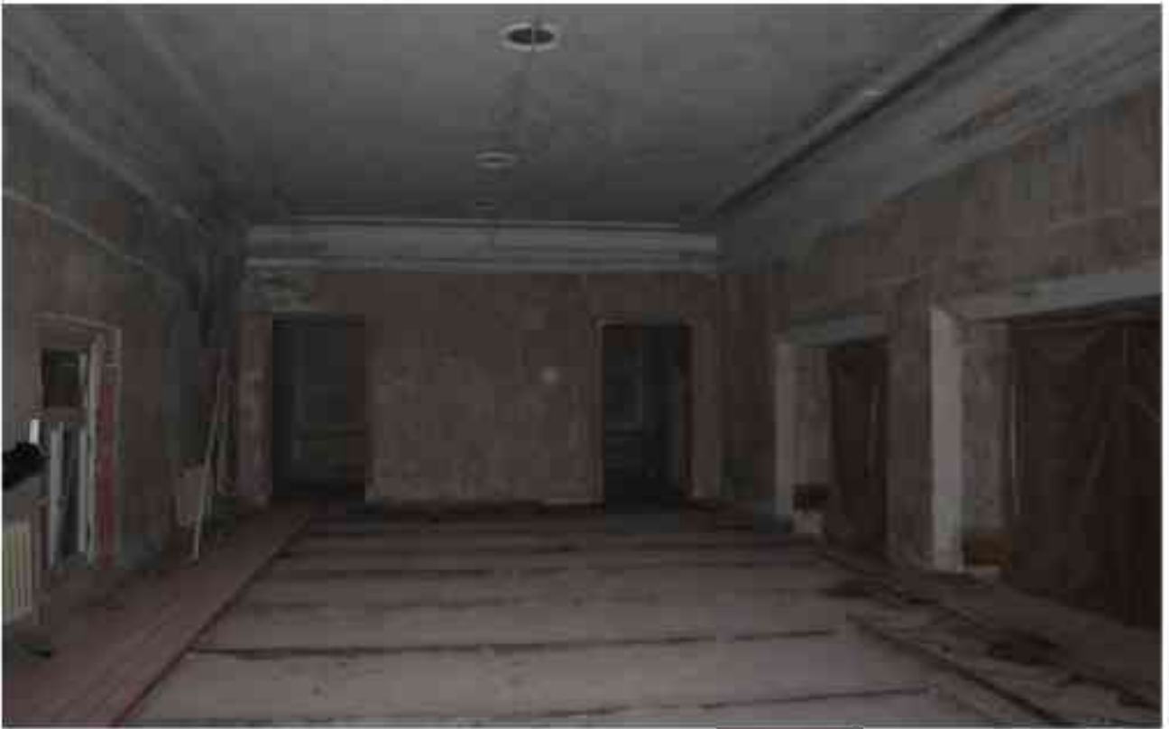
Фото 4.14. 4 этаж, помещение 33Н (38).
