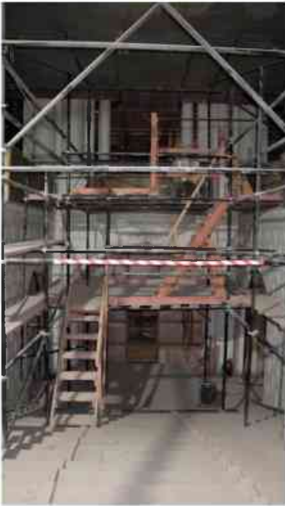
Фото 1.280. 1 этаж, лестница Л-11.
