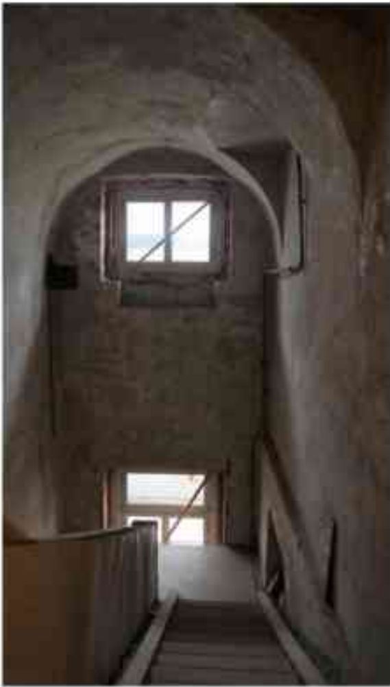
Фото 5.34. 5 этаж, лестница Л-6.
