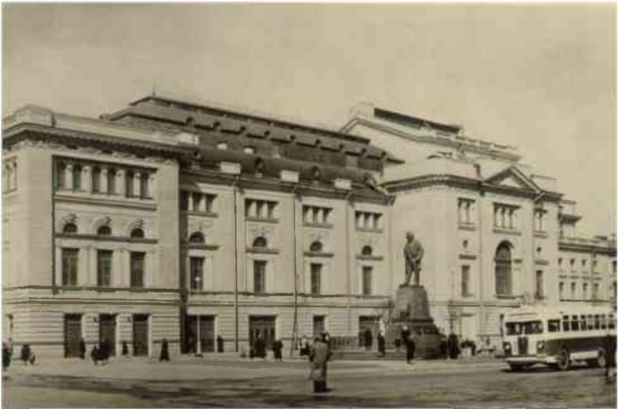
264. Фото 1953 г. Здание Консерватории. Южный фасад.
