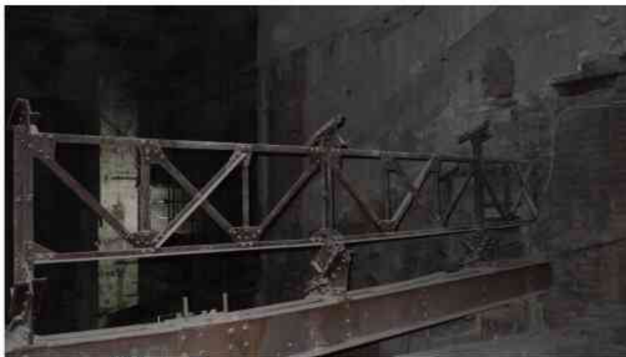
Фото 4.203. 4 этаж, помещение 30Н (3).
