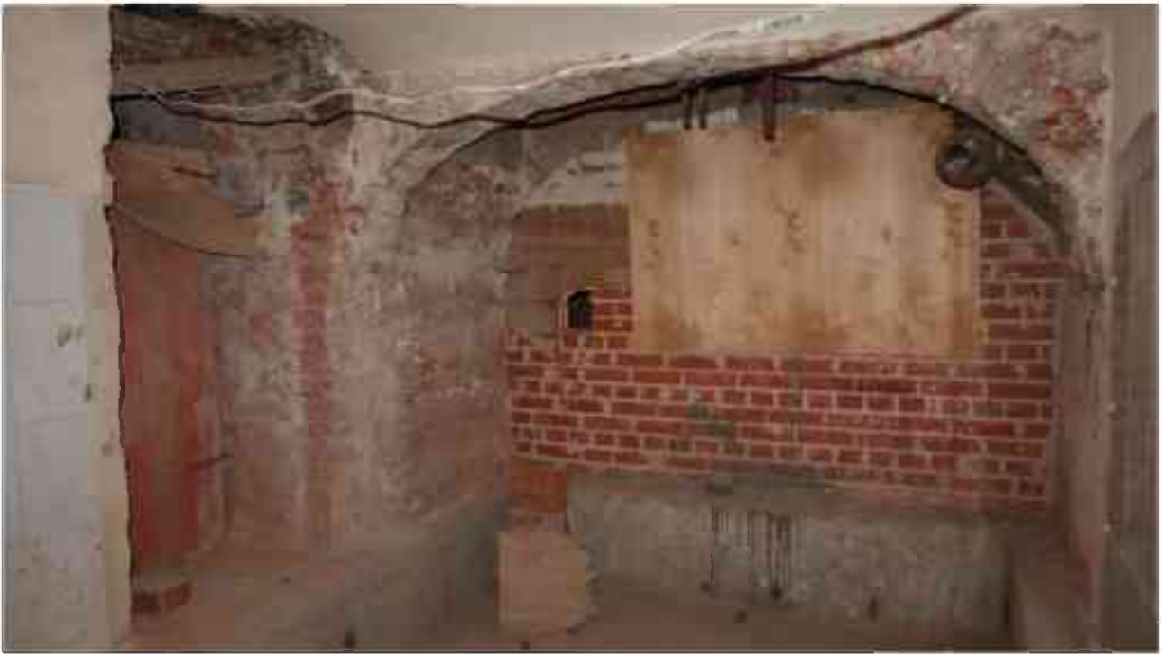
Фото п.284. Подвал, помещение 6Н (13).
