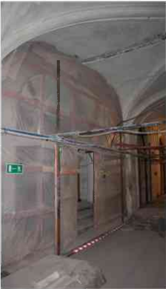
Фото 1.252. 1 этаж, помещение 13Н (10).
