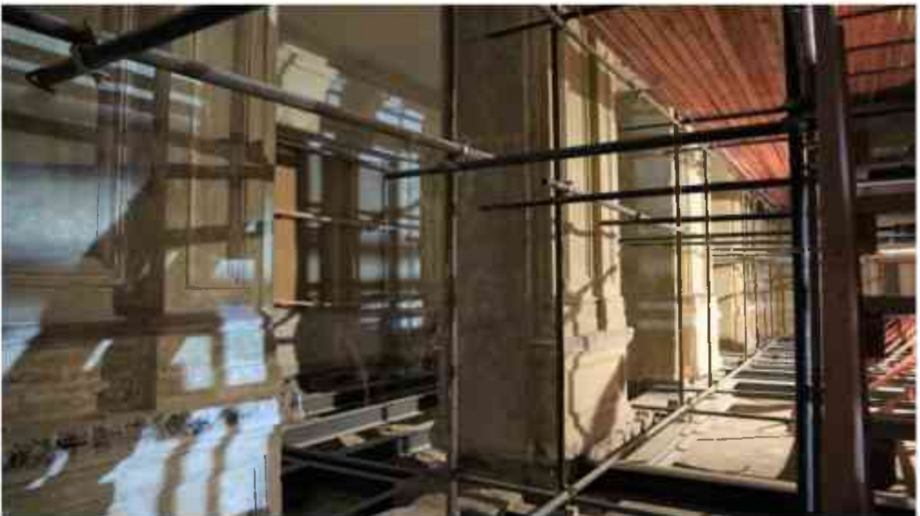
Фото 2.156. 2 этаж, помещение 22Н (19).
