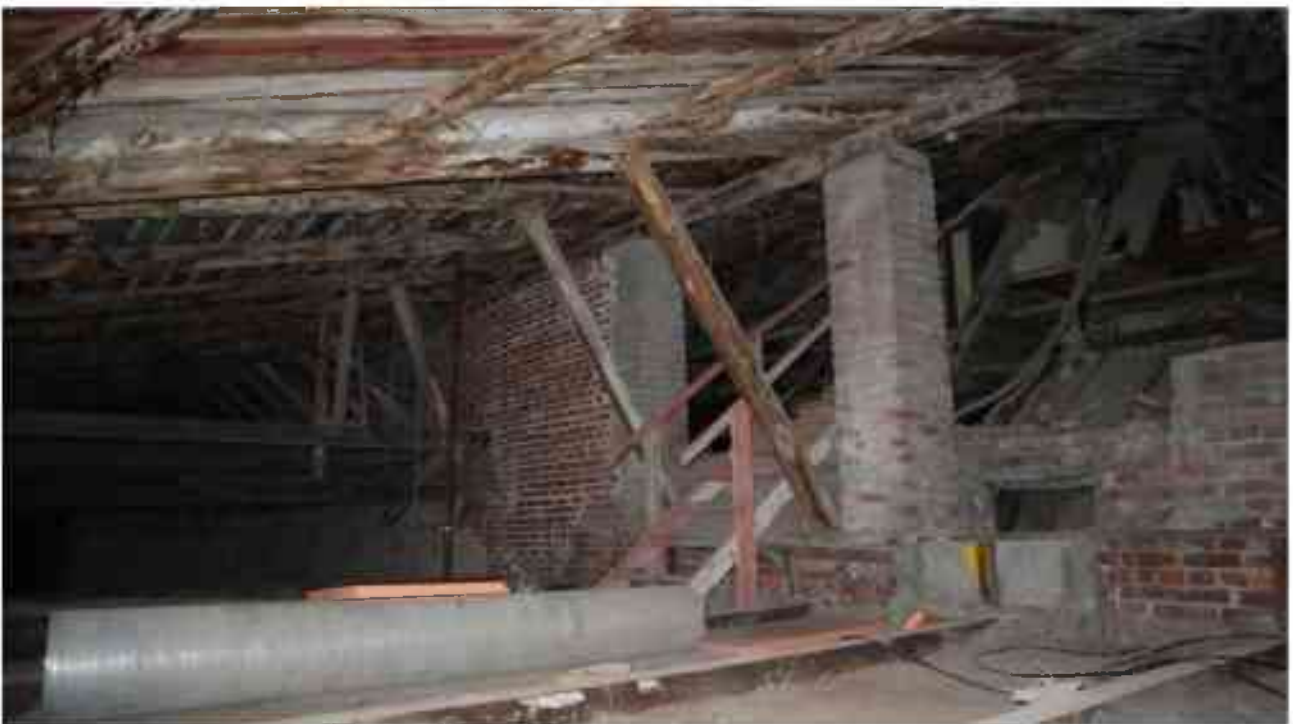
Фото 6.65. 6 этаж, чердачное помещение.
