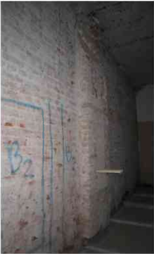
Фото 3.97. 3 этаж, помещение 27Н (1).
