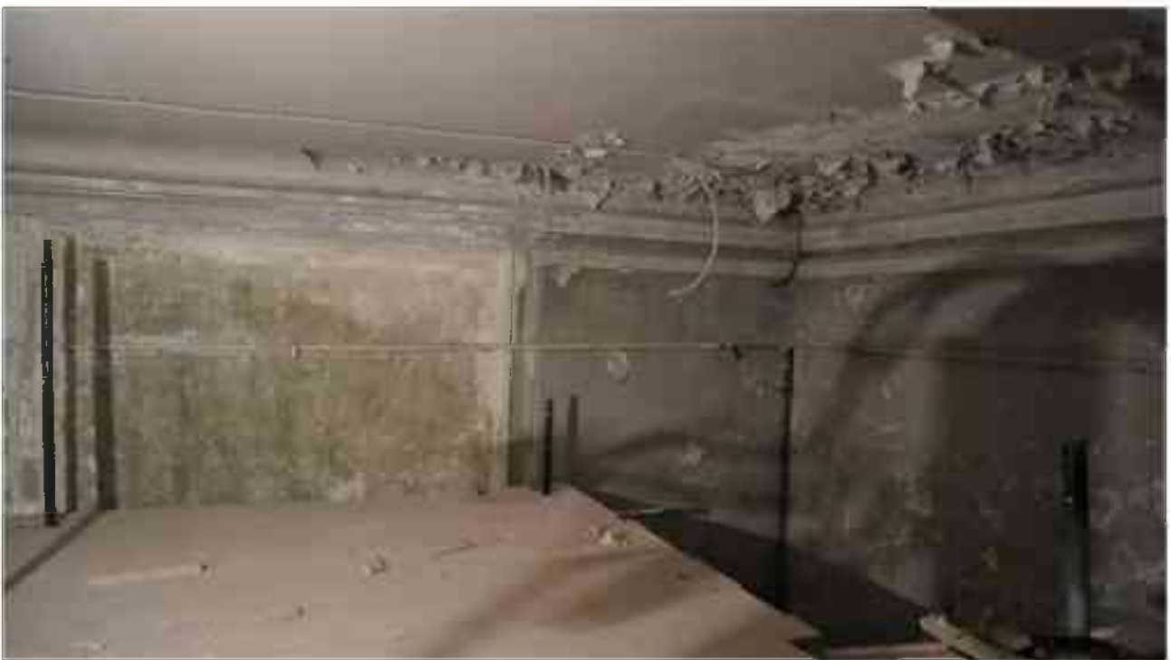
Фото 5.109. 5 этаж, лестница в ризалите южного фасада (западная часть).*
