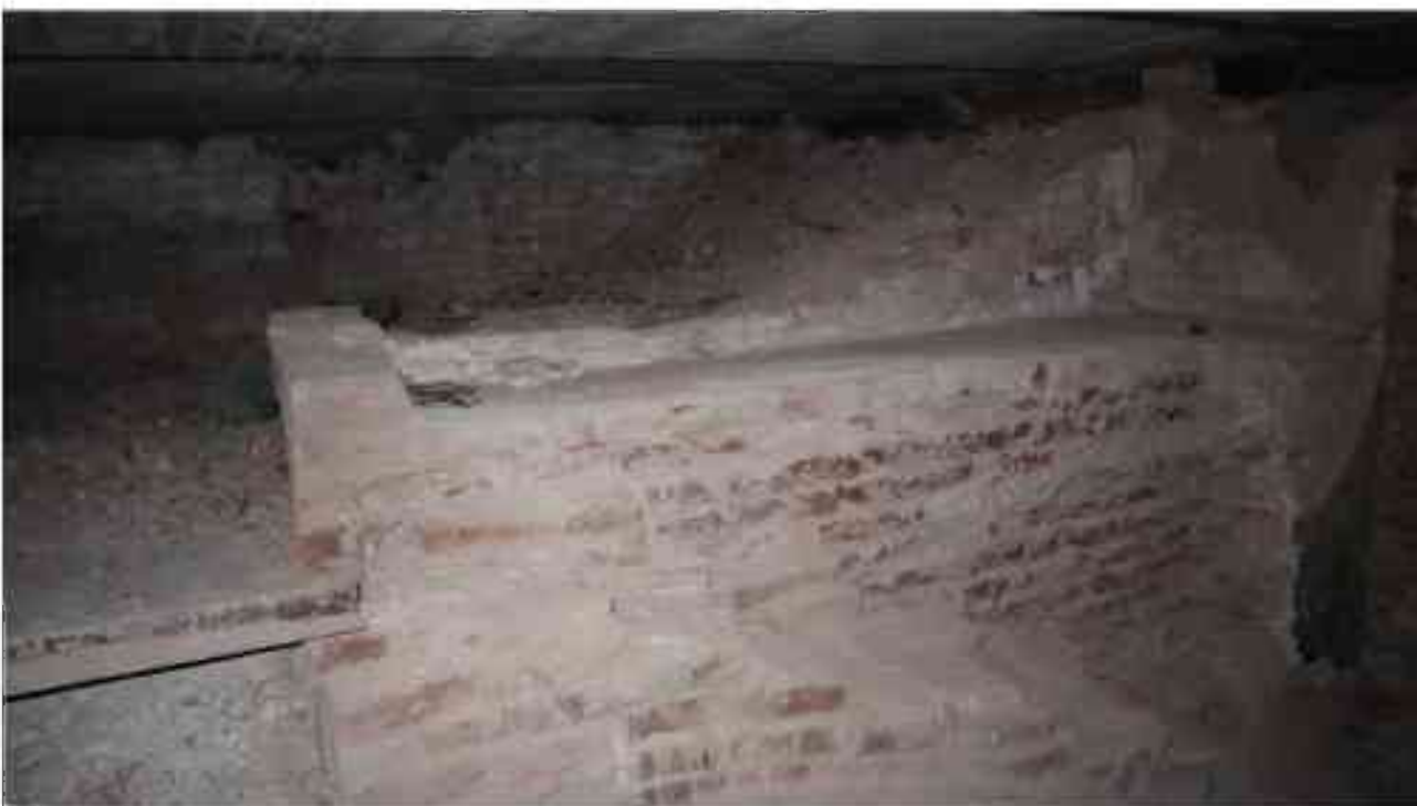
Фото 1.350. 1 этаж, помещение в центре здания, западнее лестницы с перекрестными маршами.*
