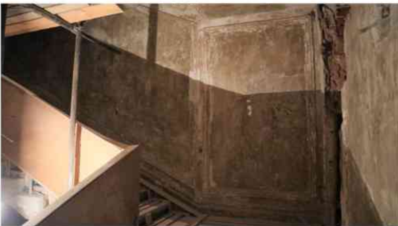
Фото 2.165. 2 этаж, лестница Л-10.
