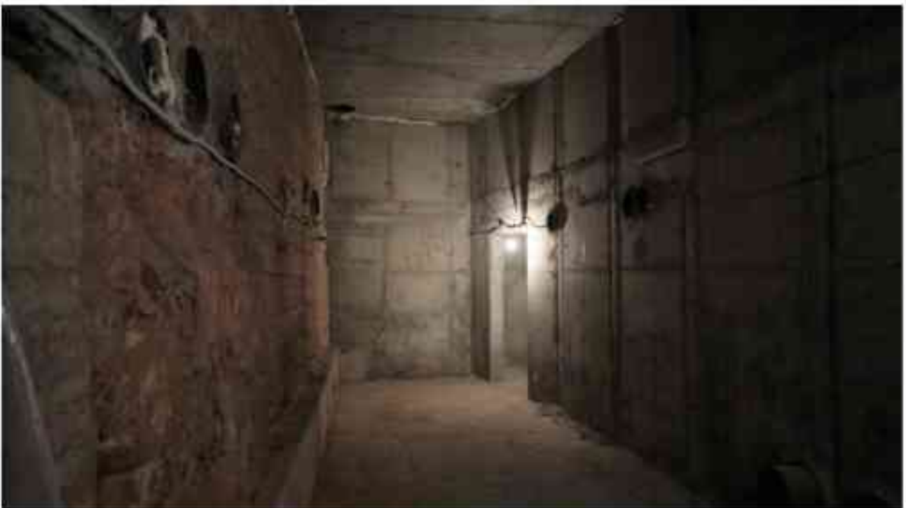
Фото п.31. Подвал, помещение 3Н (10-11).
