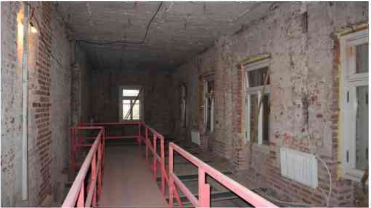
Фото 4.115. 4 этаж, коридор, помещение 29Н (1-2).
