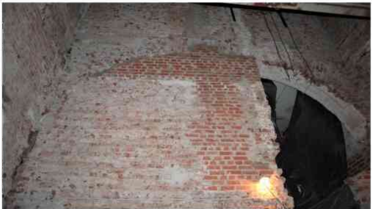
Фото п.52. Подвал, помещение 3Н (14).
