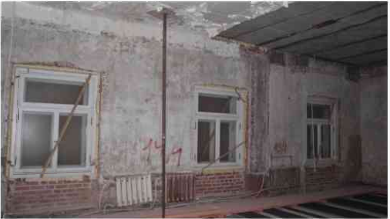
Фото 4.36. 4 этаж, помещение 33Н (40, 41).
