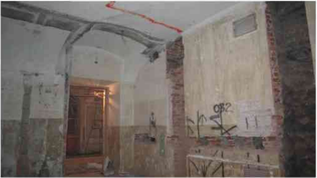
Фото 3.58. 3 этаж, помещение 28Н (14-17).
