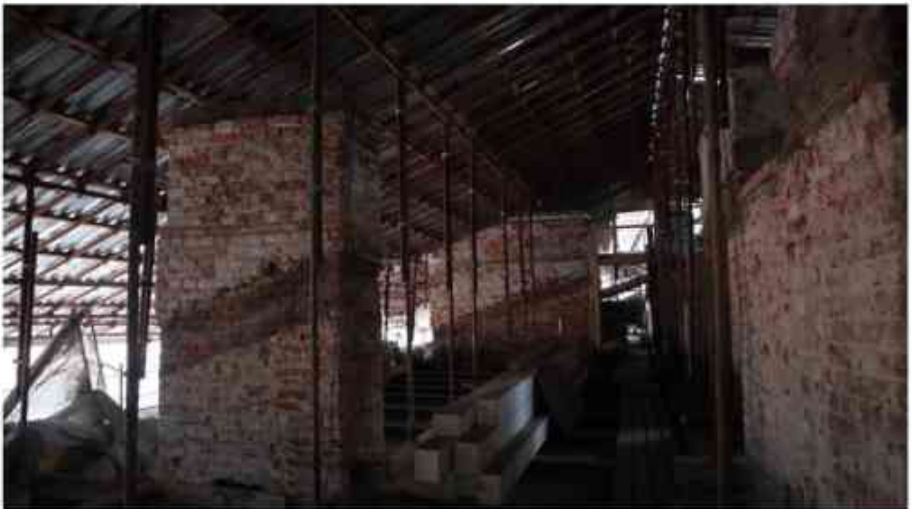
Фото 6.41. 6 этаж, чердачное помещение.
