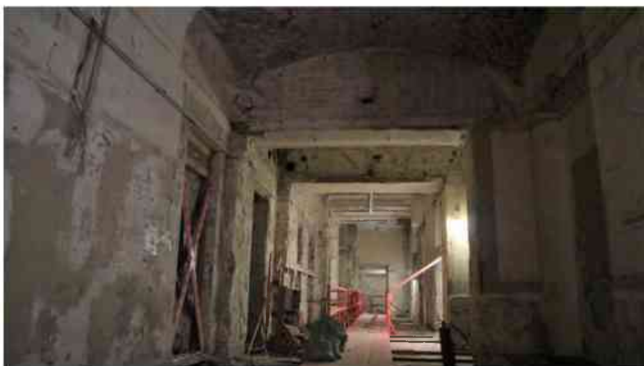
Фото 2.208. 2 этаж, помещение 22Н (10).
