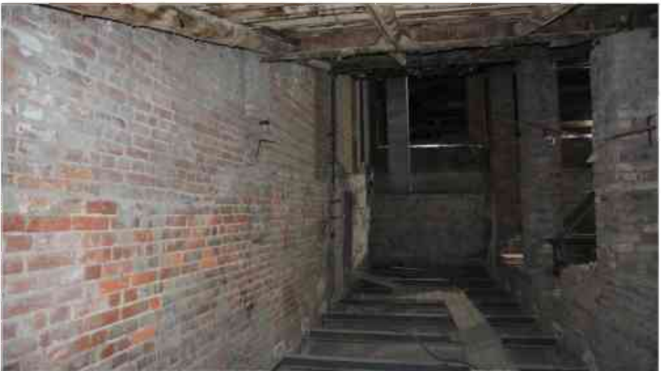
Фото 5.81. 5 этаж, чердачное помещение, купол.
