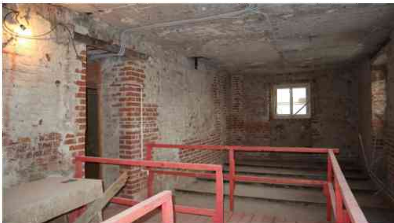
Фото 5.38. 5 этаж, помещение 38Н (1).
