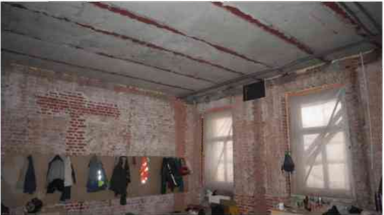
Фото 3.12. 3 этаж, помещение 28Н (38-39).
