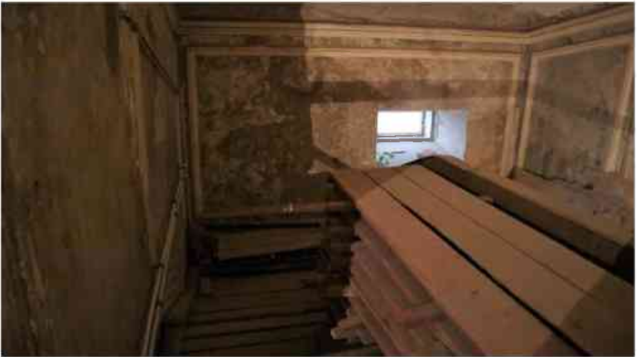
Фото 5.110. 5 этаж, лестница Л-10.
