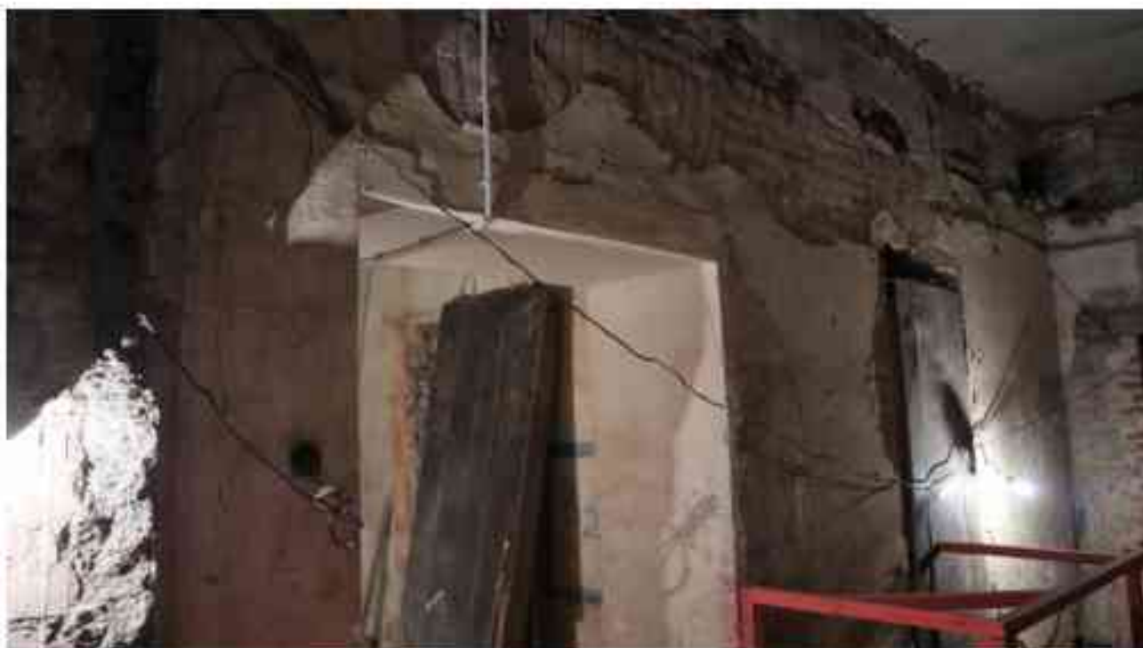
Фото 1.213. 1 этаж, помещение 15Н (5-6).
