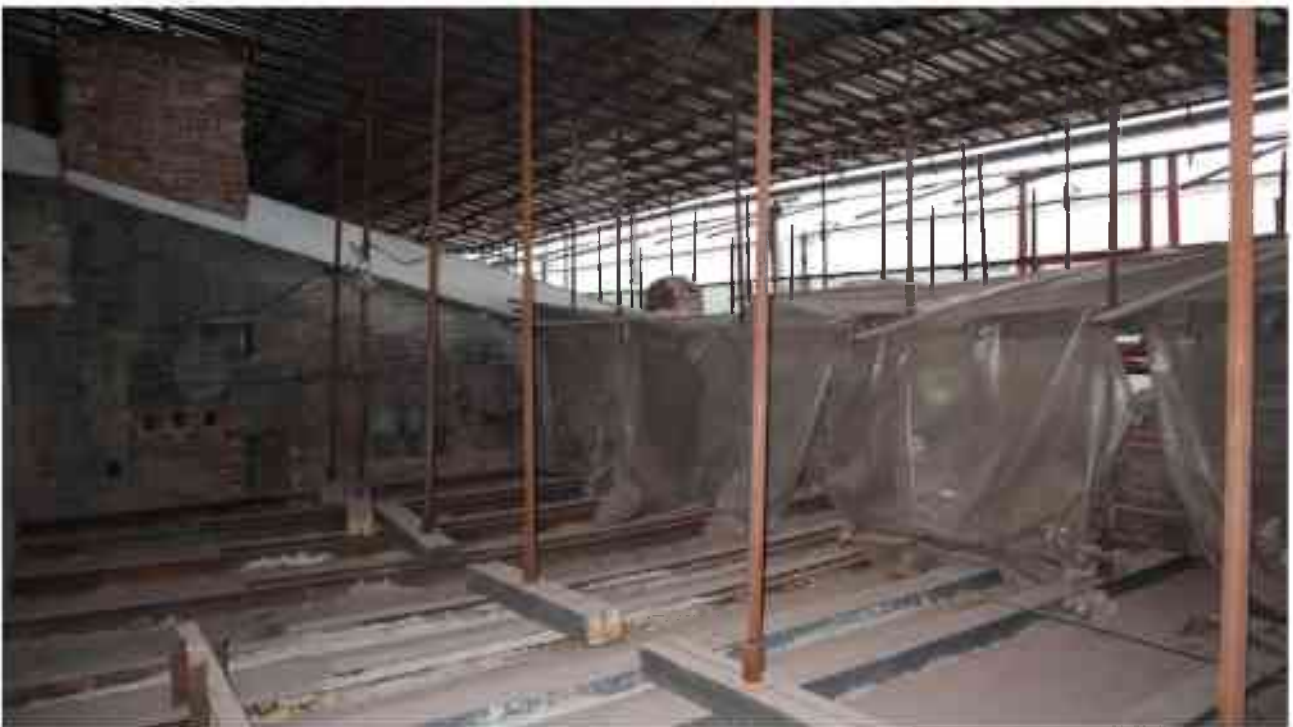
Фото 5.157. 5 этаж, чердачное помещение.
