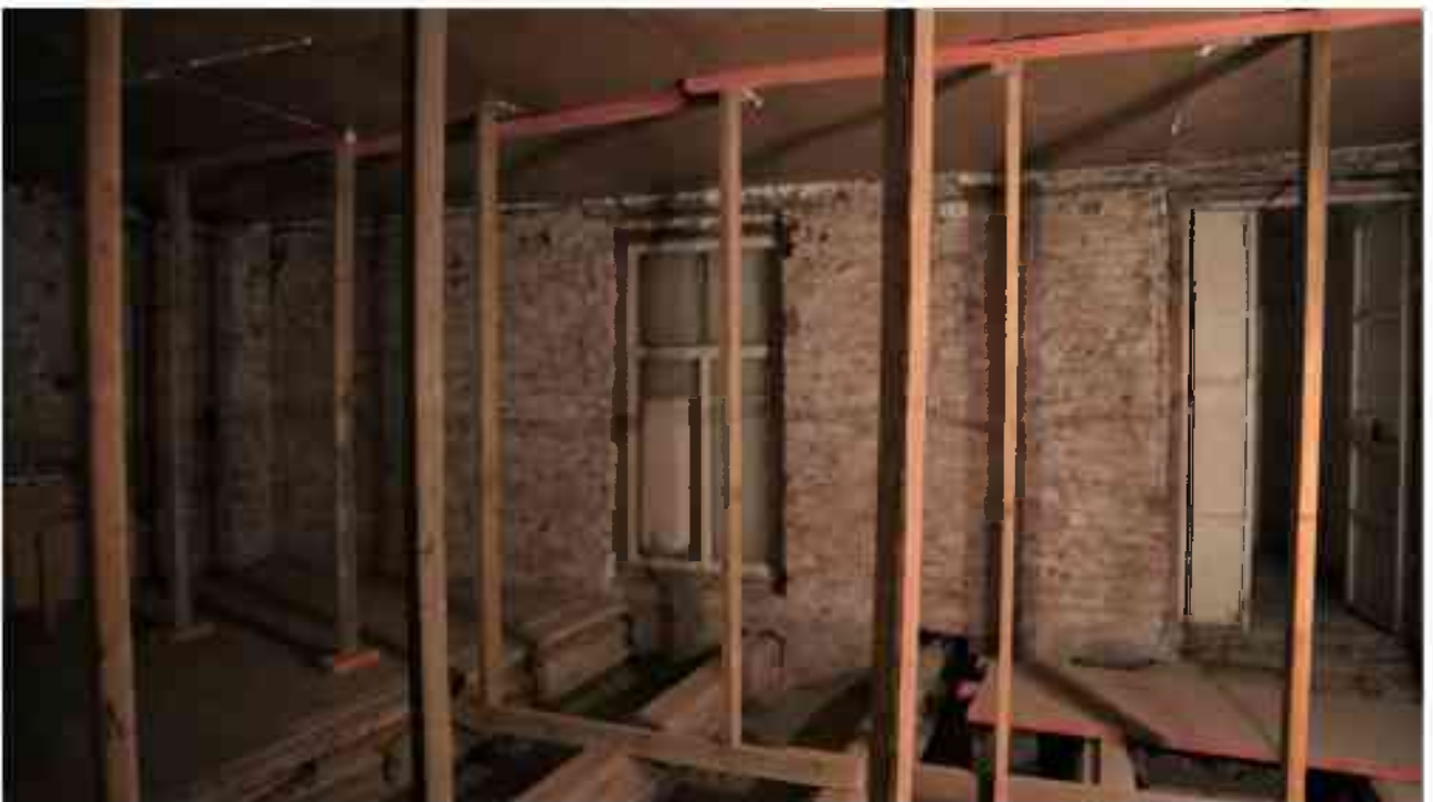
Фото 4.182. 4 этаж, помещение 32Н (1-2).
