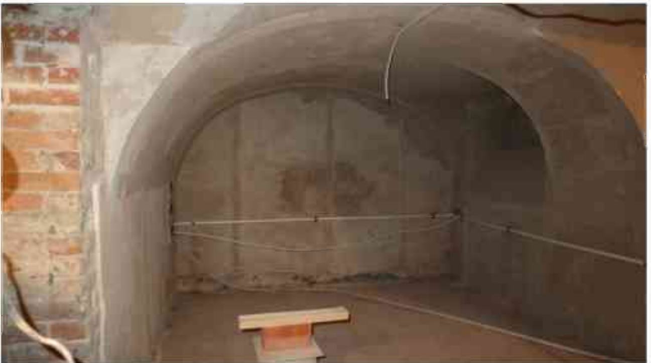
Фото п.6. Подвал, помещение 1Н (1-3).
