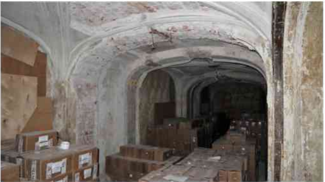
Фото 1.261. 1 этаж, помещение 13Н (24-25, 34).
