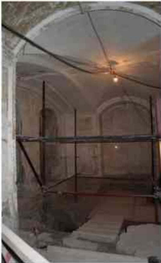
Фото 1.288. 1 этаж, помещение 13Н (4).
