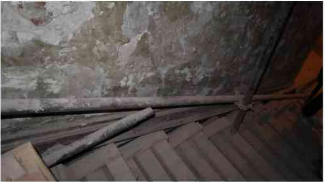
Фото 1.223. 1 этаж, лестница Л-7.
