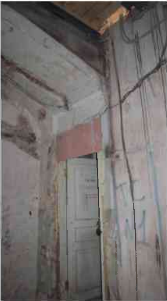
Фото 1.104. 1 этаж, помещение 14Н (29).
