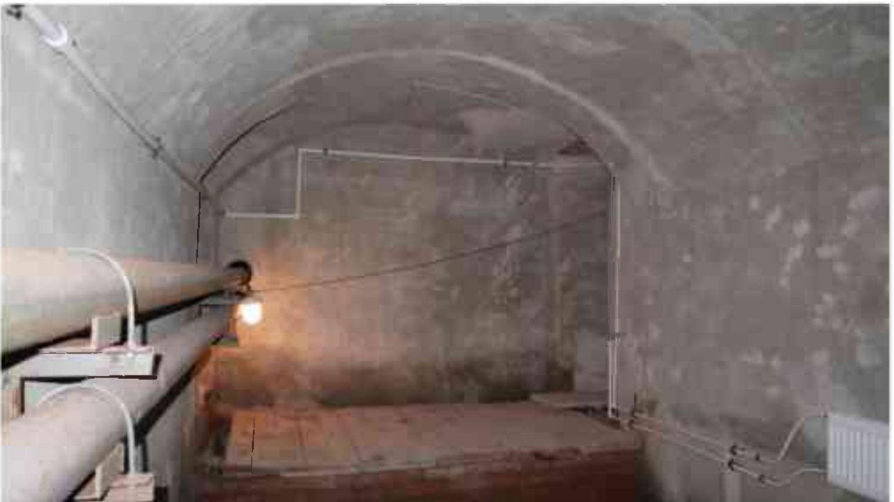
Фото п.71. Подвал, помещение 3Н (3).
