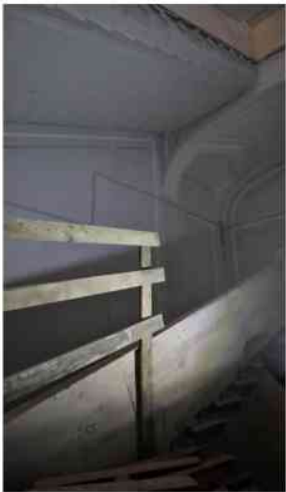
Фото 1.106. 1 этаж, лестница Л-16.
