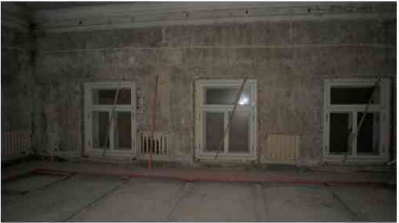
Фото 4.16. 4 этаж, помещение 33Н (38).
