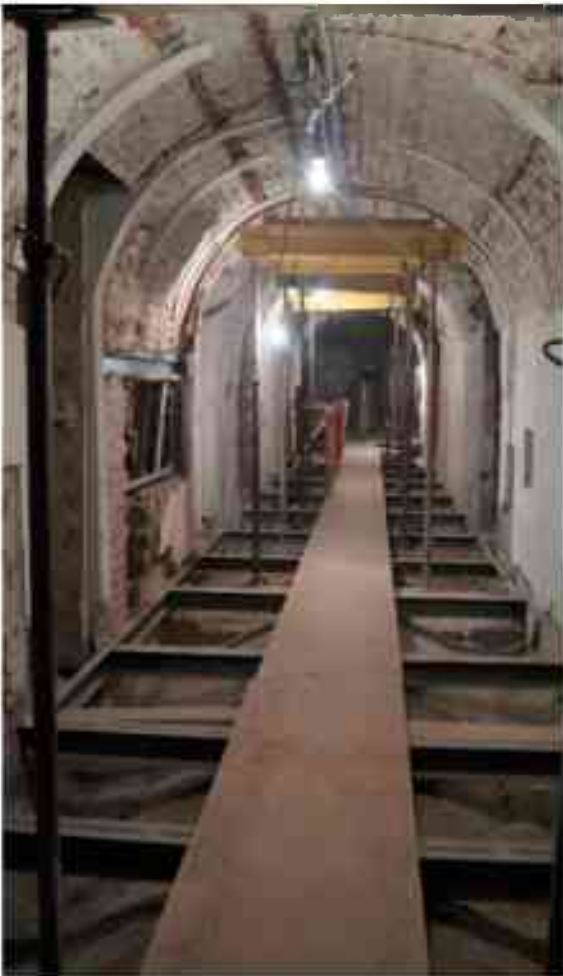
Фото 5.6. 5 этаж, помещение 37Н (1).
