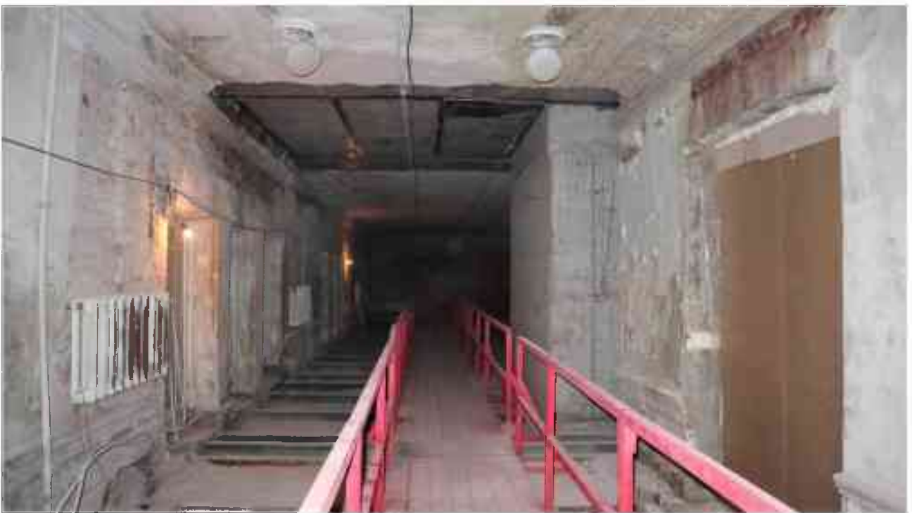
Фото 4.135. 4 этаж, помещение 30Н (1).
