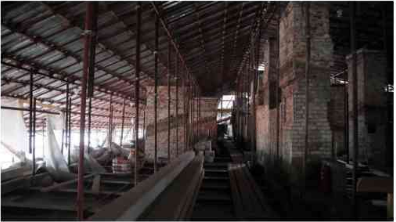
Фото 6.40. 6 этаж, чердачное помещение.
