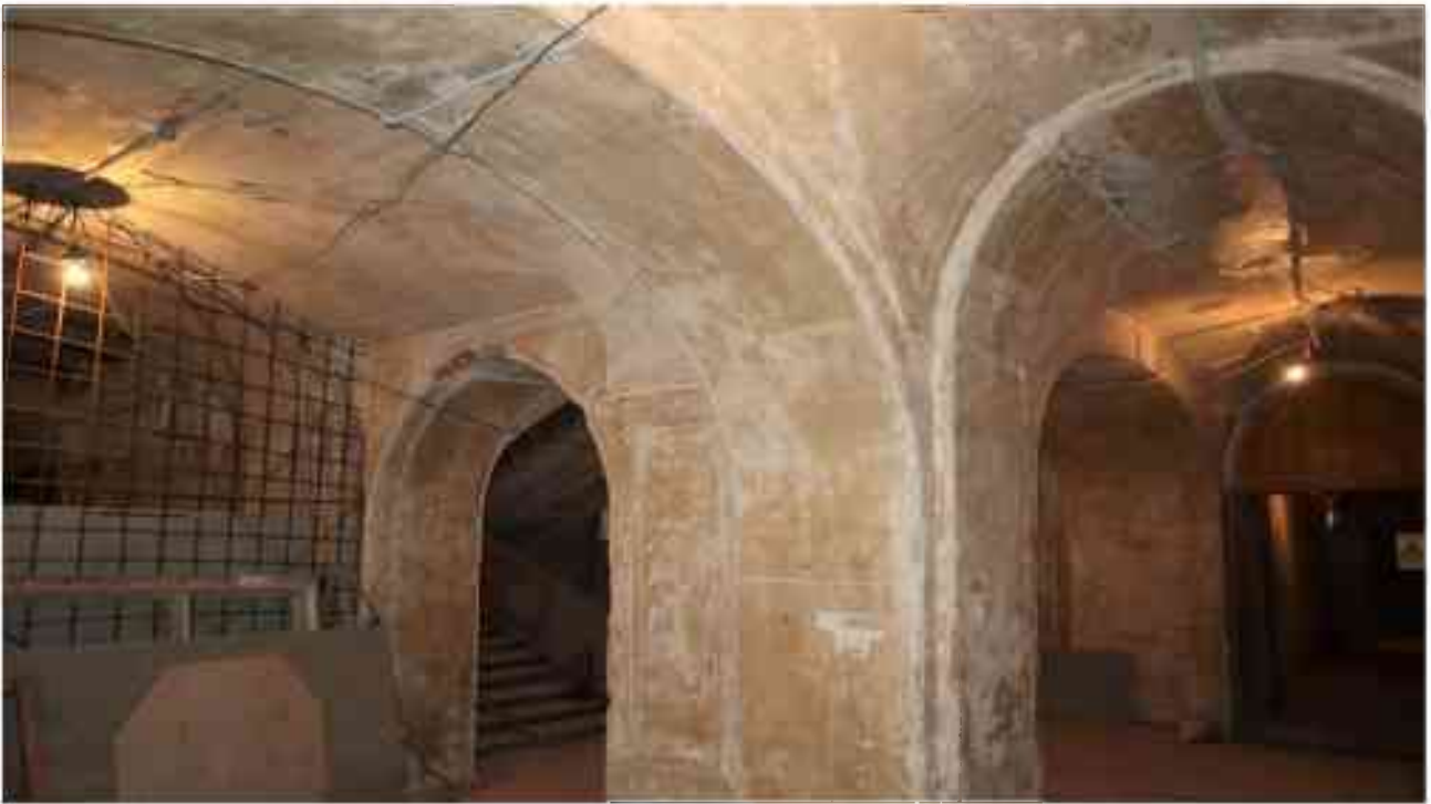
Фото 1.131. 1 этаж, помещение 31Н (15).
