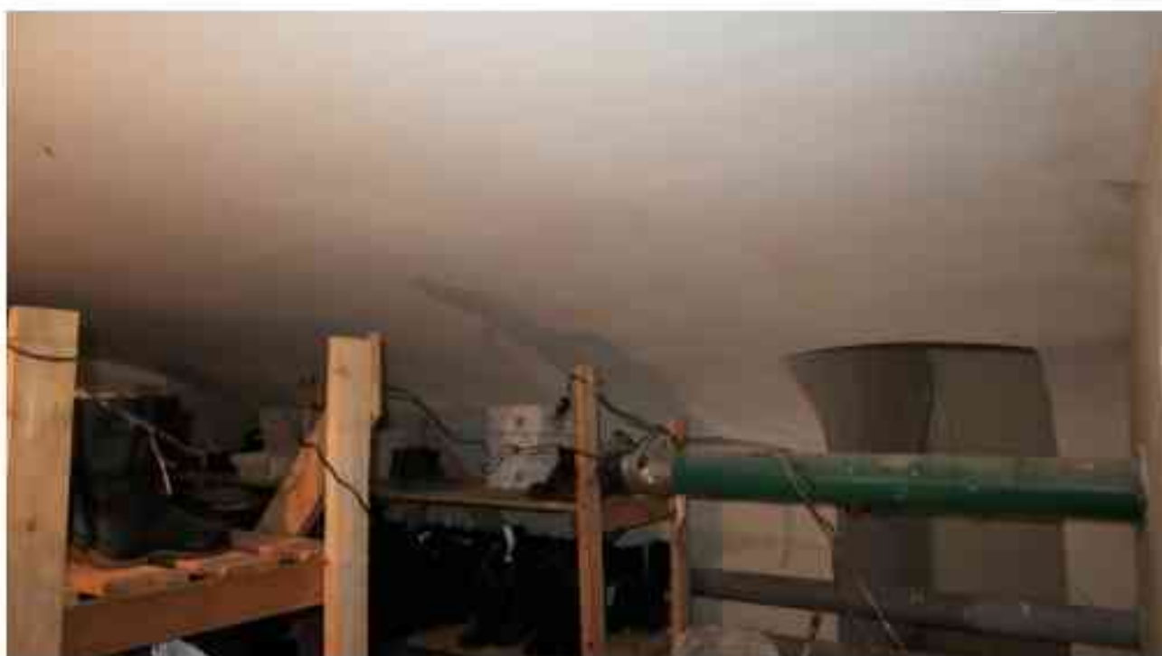
Фото п.123. Подвал, помещение 4Н (3-5).
