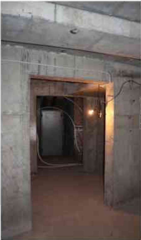
Фото п.40. Подвал, помещение 3Н (12).
