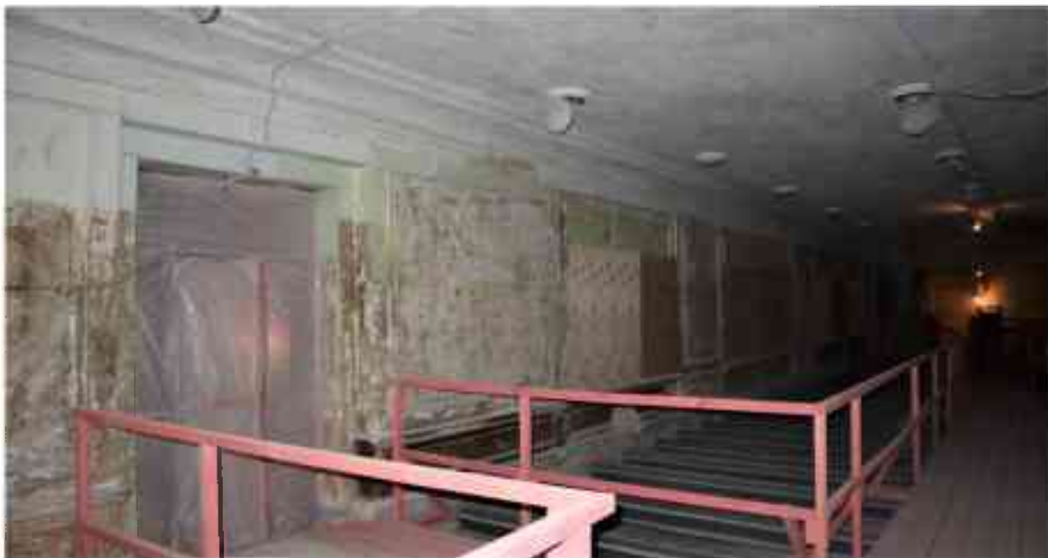
Фото 4.149. 4 этаж, помещение 30Н (5).
