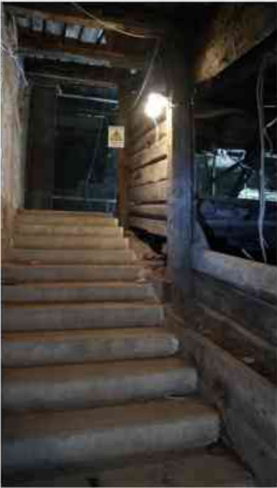
Фото 6.17. 6 этаж, чердачное помещение.
