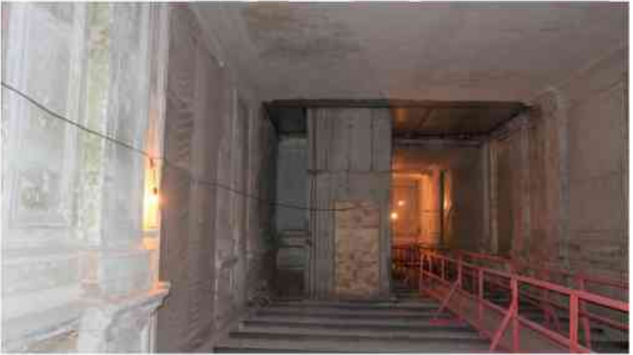
Фото 2.168. 2 этаж, помещение 22Н (17).
