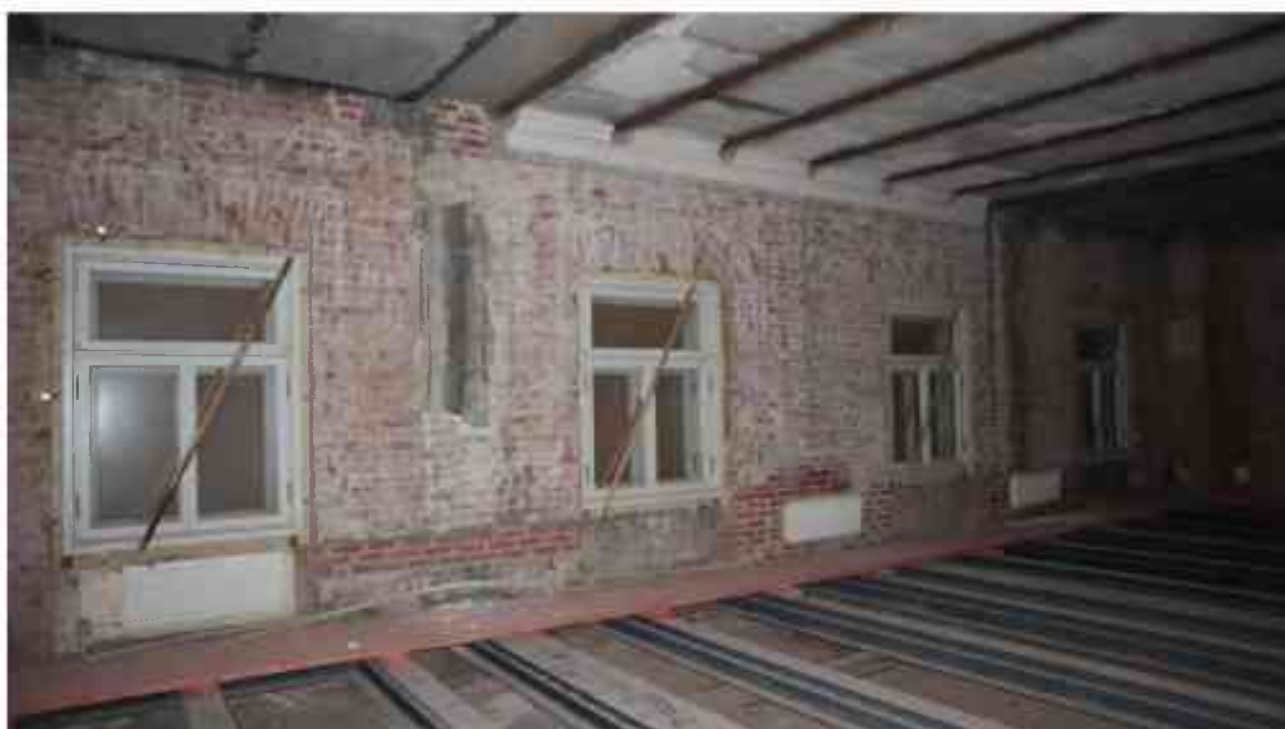
Фото 4.62. 4 этаж, помещение 33Н (47-49).
