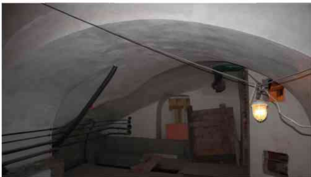
Фото п.80. Подвал, помещение 4Н (13).
