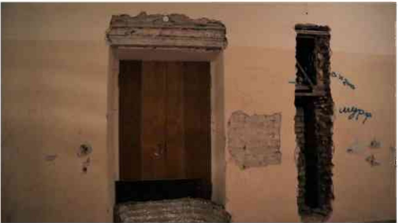
Фото 5.95. 5 этаж, помещение 35Н(1).
