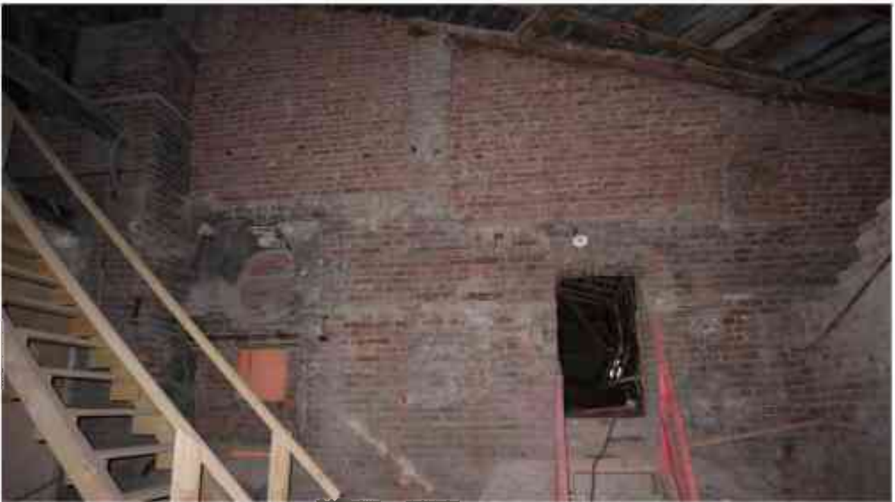
Фото 5.74. 5 этаж, помещение 35Н (4-6).
