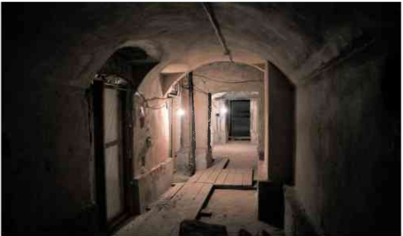
Фото п.221. Подвал, помещение 9Н (3).
