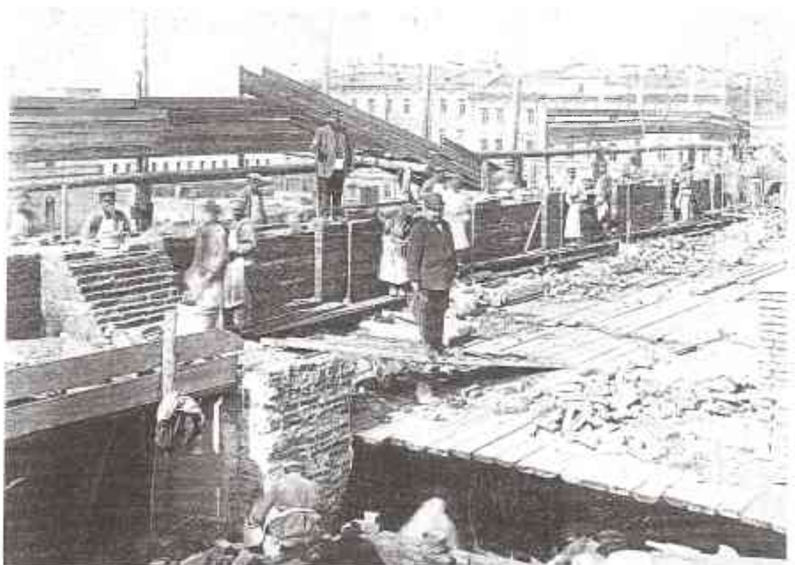
Ил. 123. Строительство здания Консерватории. Фото. Начало 1890-х гг. Опубл.: Санкт-Петербургская консерватория. Документы и материалы из фондов Библиотеки и Музея. Т. 1. СПб, 2002. С. 100.
