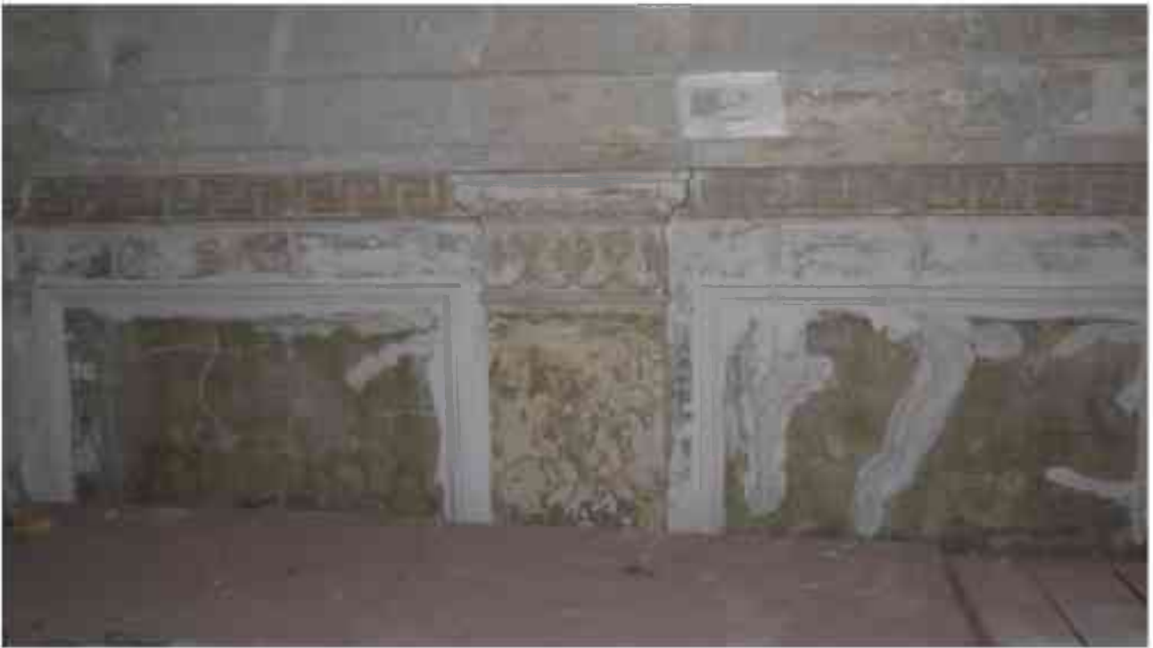
Фото 3.150. 3 этаж, помещение 25Н (11).*
