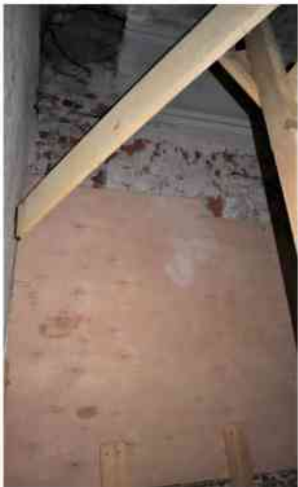
Фото 1.233. 1 этаж, помещение 15Н (3).
