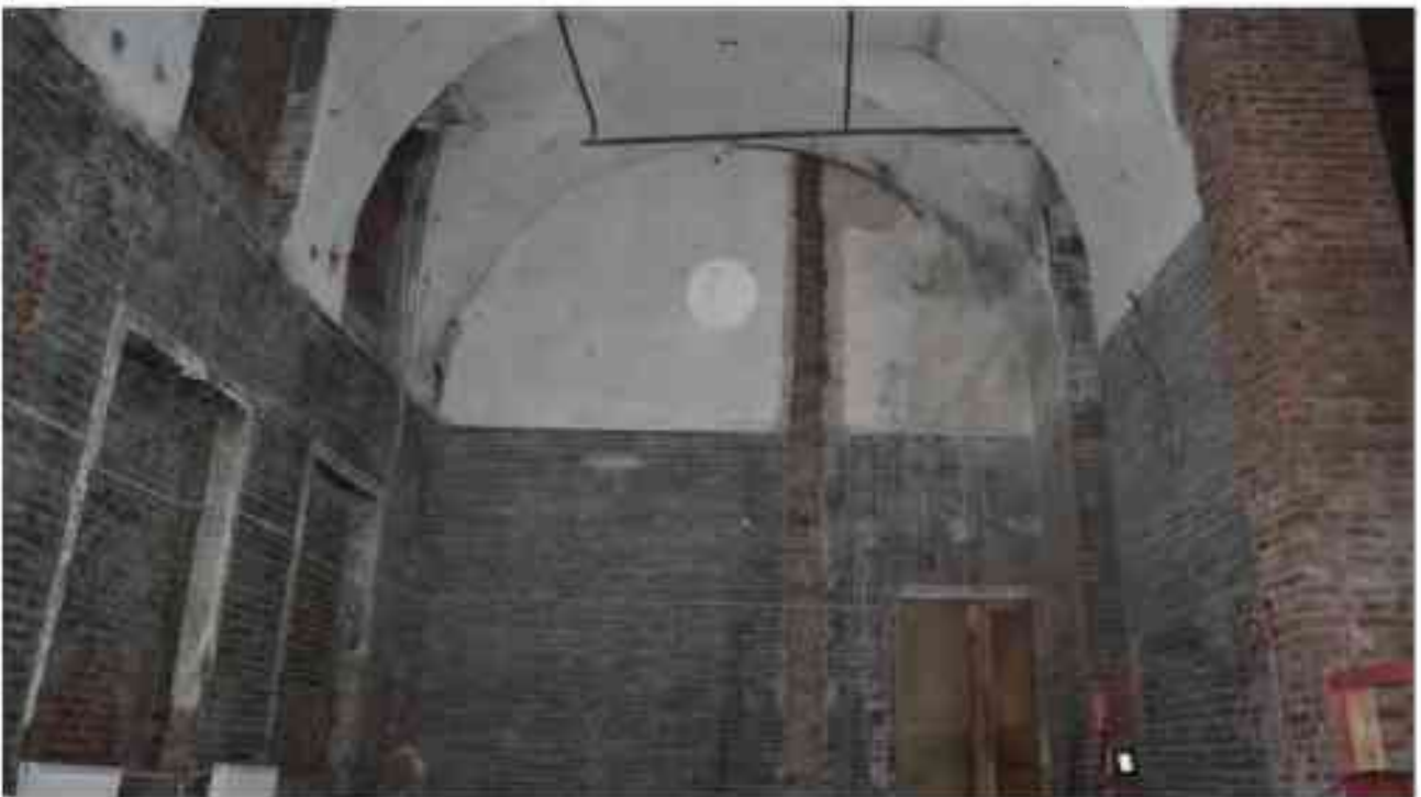
Фото 2.220. 2 этаж, помещение 22Н (83).
