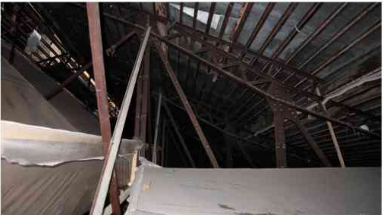
Фото 5.119. Чердак уровня 5 этажа.
