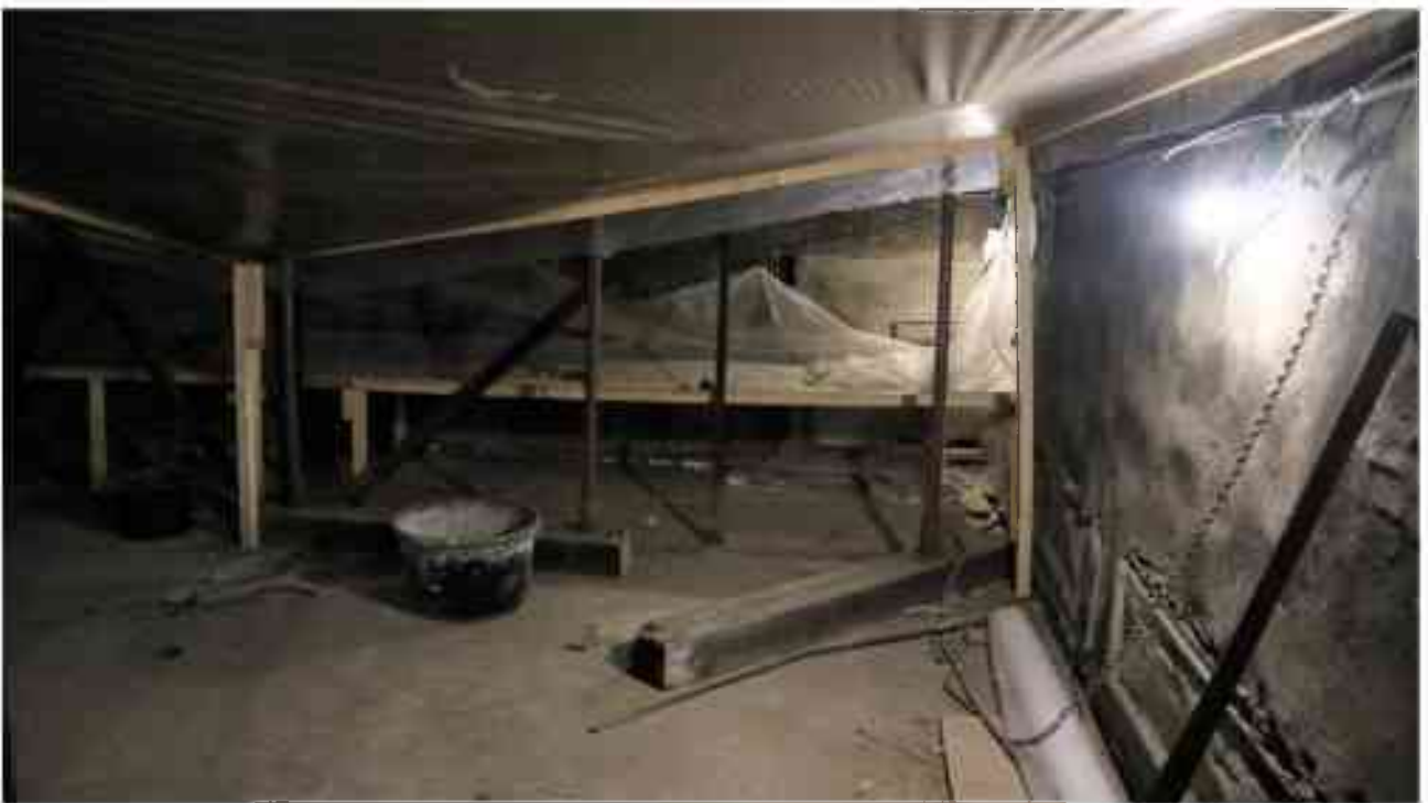
Фото 5.113. Чердак уровня 5 этажа.
