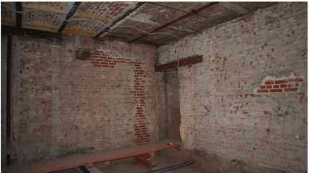
Фото 4.193. 4 этаж, помещение 42Н* (3-4, 8-9).
