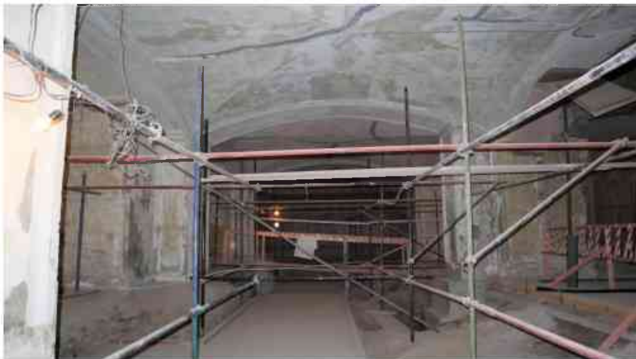
Фото 1.289. 1 этаж, помещение 13Н (4).
