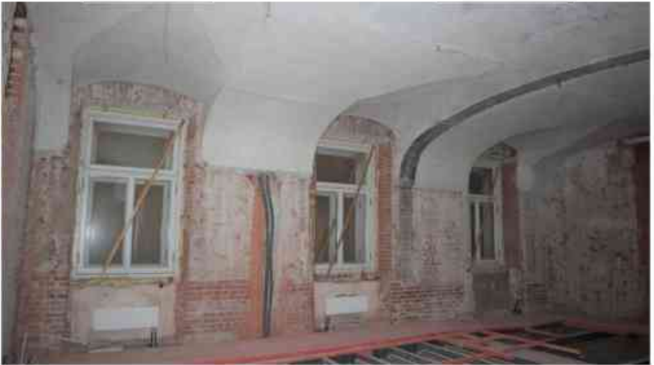
Фото 2.10. 2 этаж, помещение 22Н (45-46).
