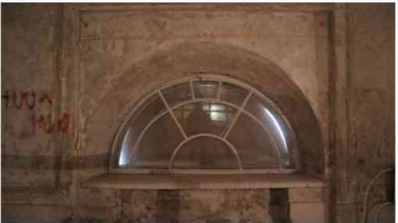
Фото 3.114. 3 этаж, помещение 25Н (1).
