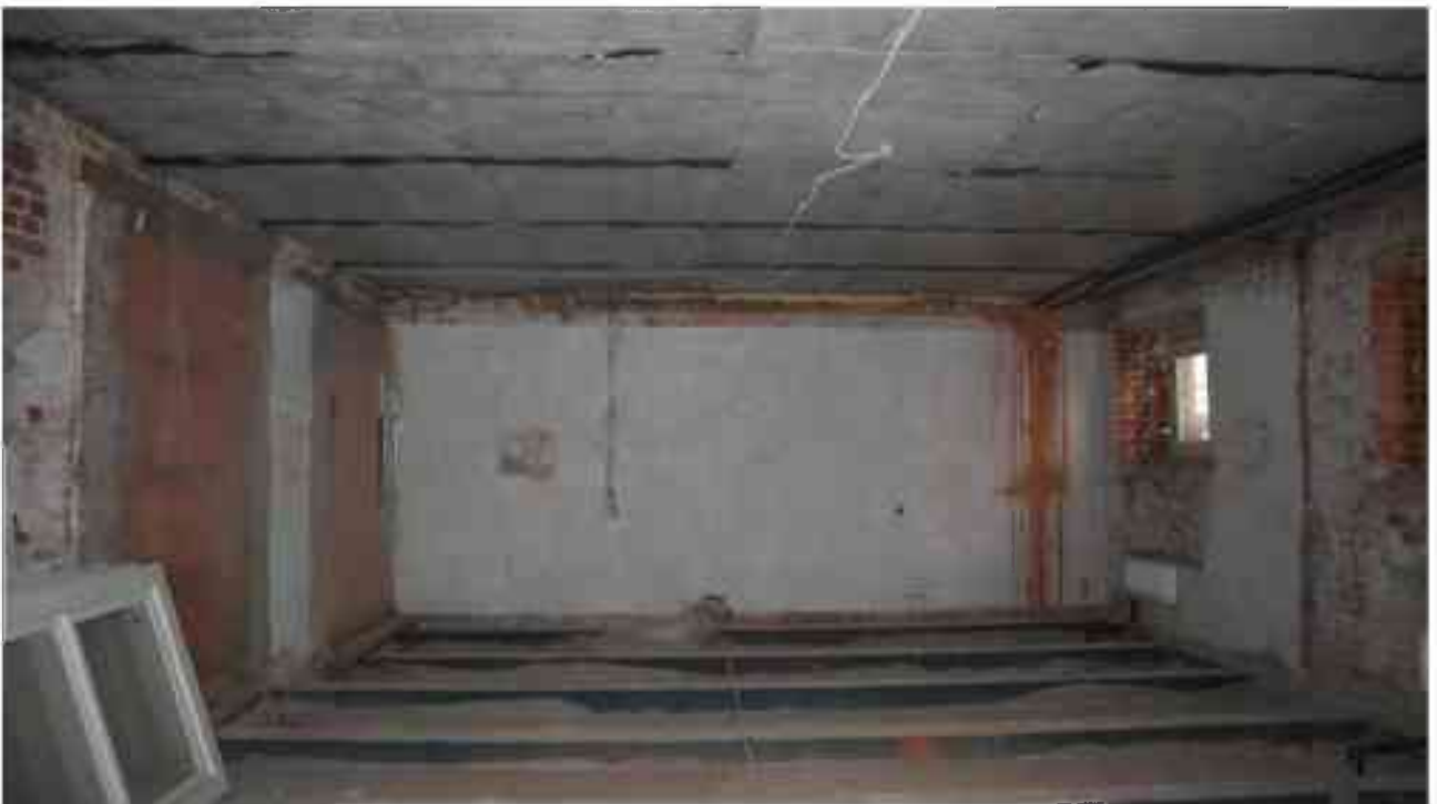
Фото 5.21. 5 этаж, помещение 37Н (6-8).
