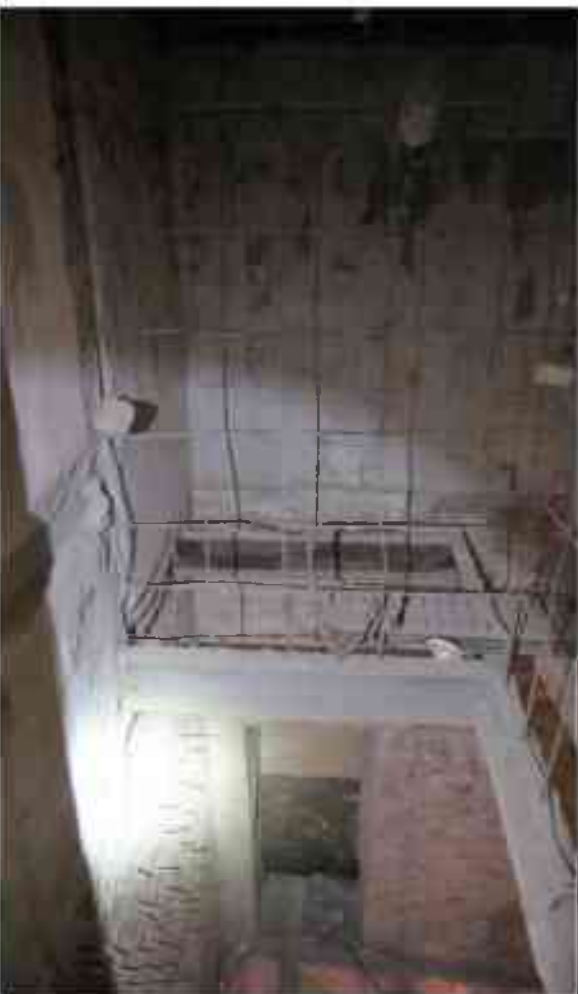
Фото 2.194. 2 этаж, помещение 22Н (8).
