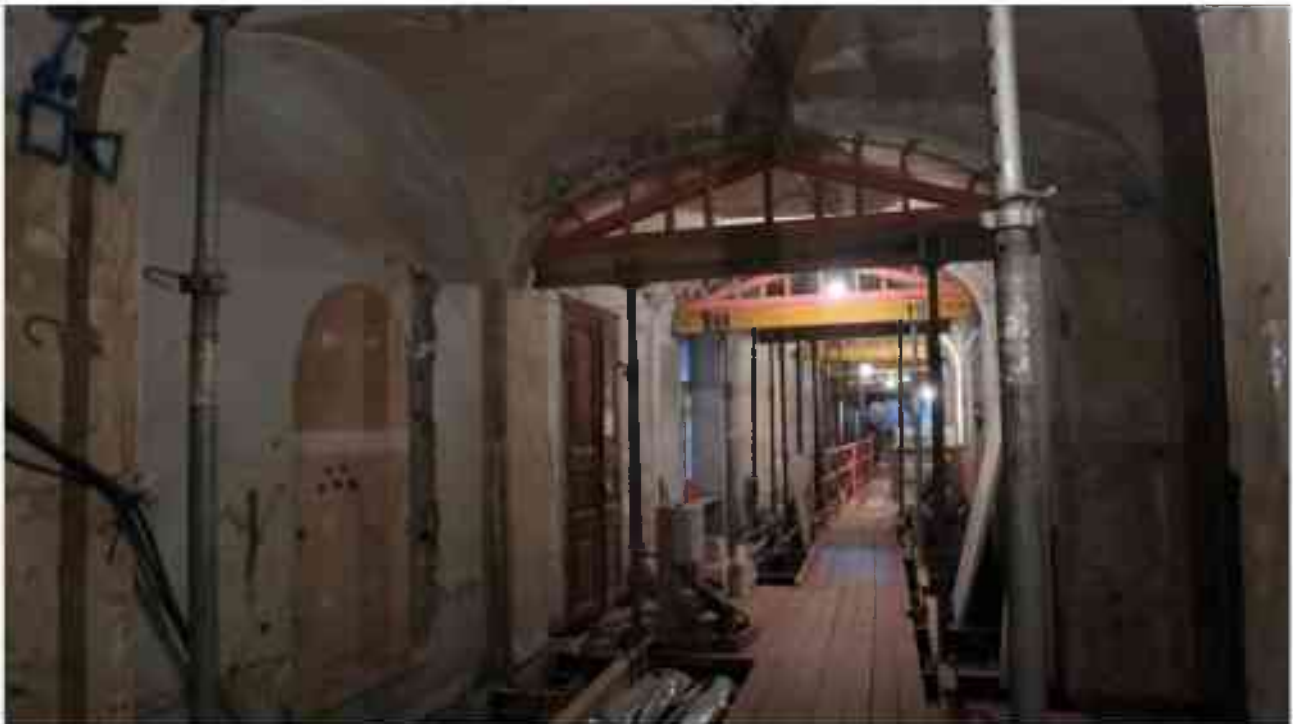
Фото 1.27. 1 этаж, помещение 14Н (14, 20).
