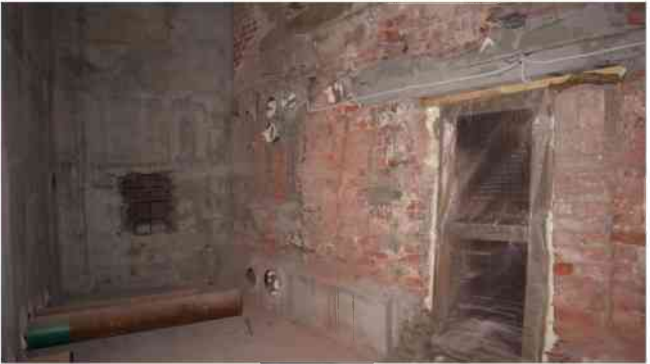
Фото п.32. Подвал, помещение 3Н (10-11).
