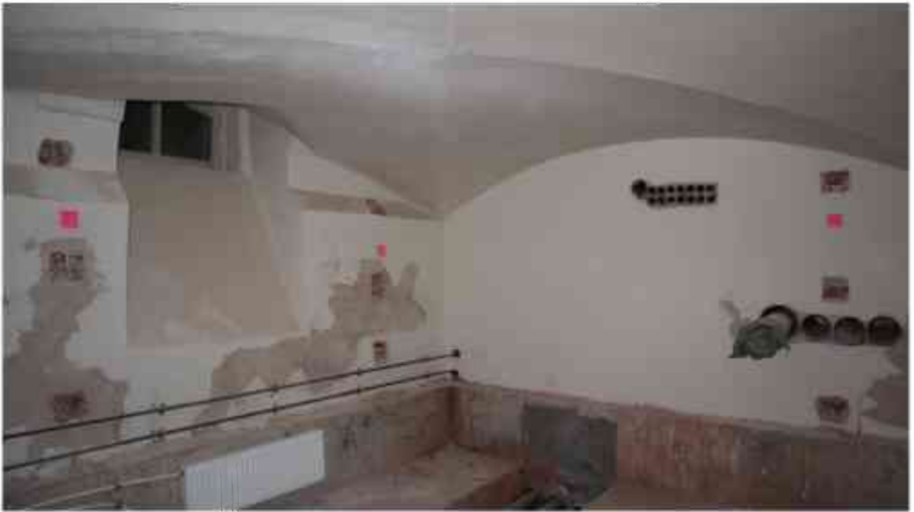
Фото п.208. Подвал, помещение 9Н (7).
