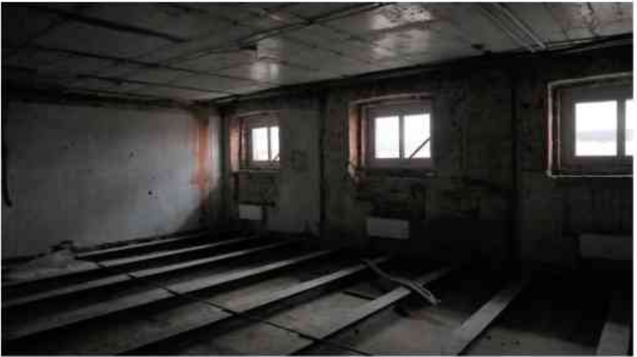
Фото 5.20. 5 этаж, помещение 37Н (6-8).
