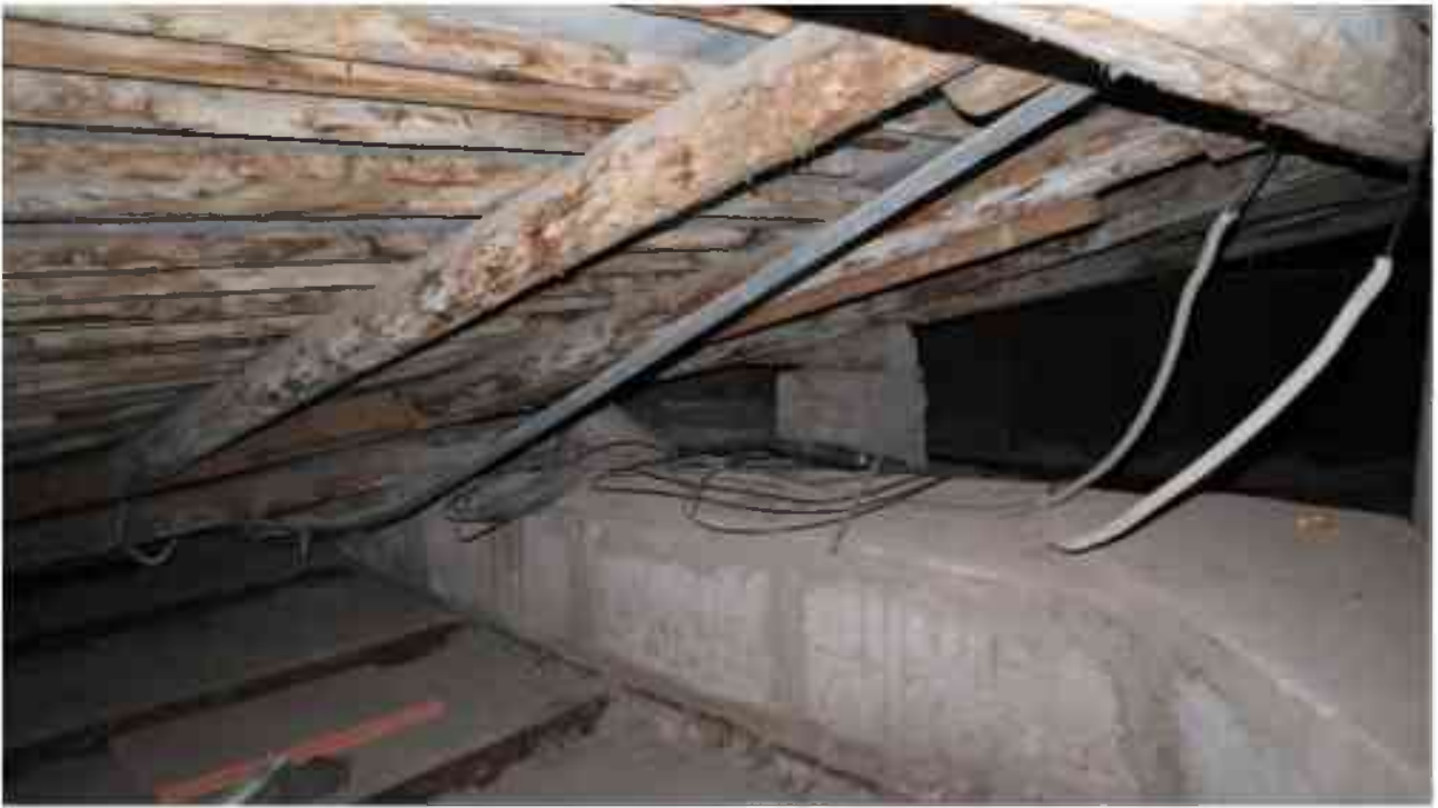
Фото 6.60. 6 этаж, чердачное помещение.
