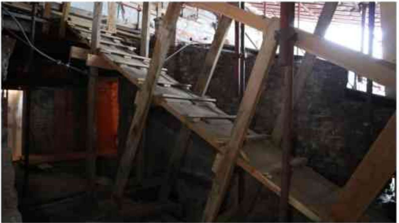
Фото 6.29. 6 этаж, чердачное помещение.
