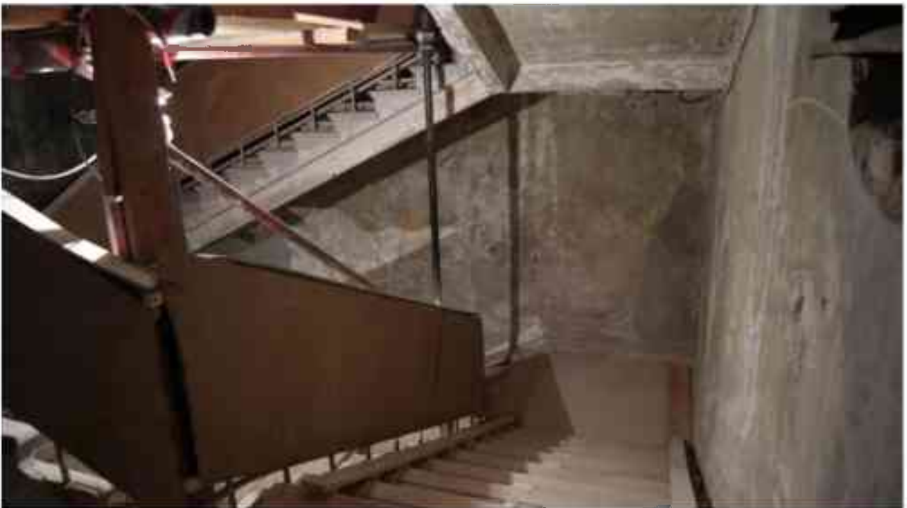
Фото 2.175. 2 этаж, лестница в ризалите южного фасада (западная часть).*
