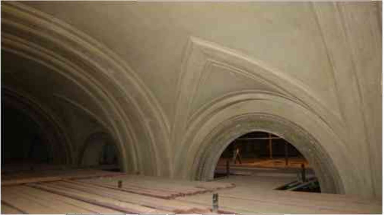
Фото 2.145. 2 этаж, помещение 22Н (19).*
