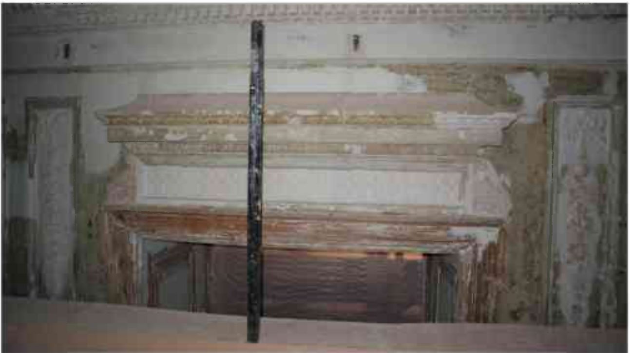
Фото 3.92. 3 этаж, помещение 28Н (12).*
