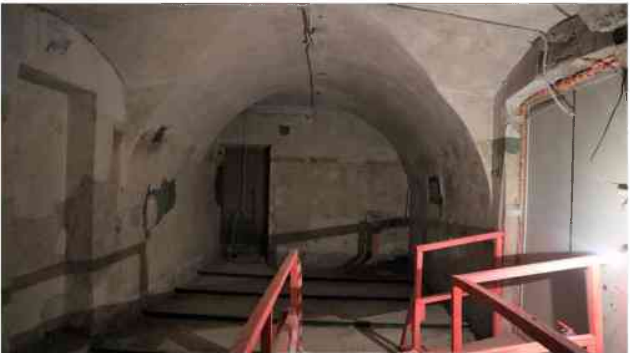
Фото 5.103. 5 этаж, помещение 35Н(4).
