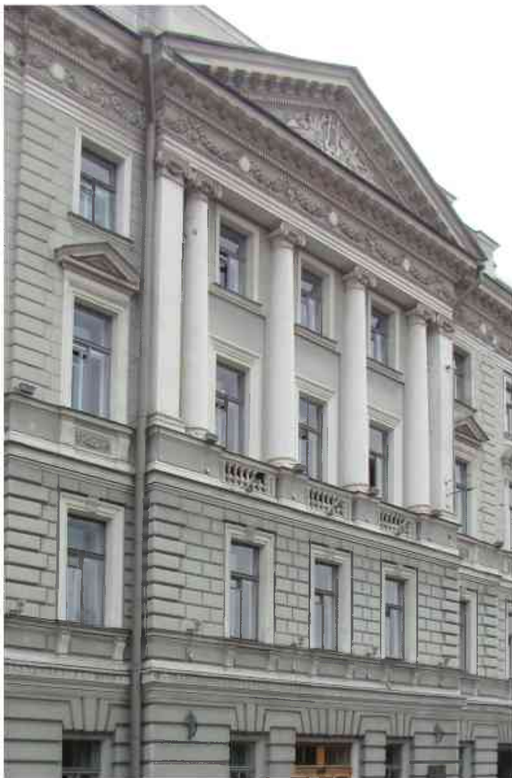
Ил. 211. Здание С.-Петербургской Консерватории им. Н. А. Римского-Корсакова. Северный фасад. Центральный ризалит. Фото 2012 года.
