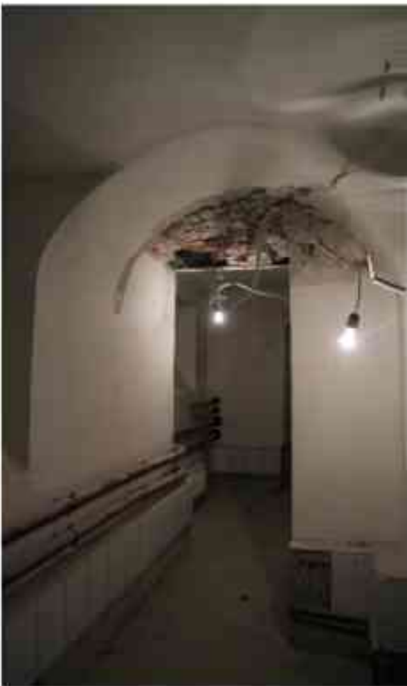
Фото п.143. Подвал, помещение 9Н (18).
