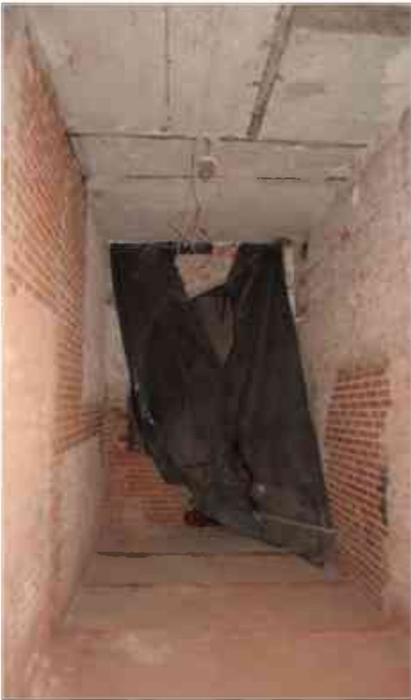
Фото 1.240. 1 этаж, помещение 17Н (7-8).
