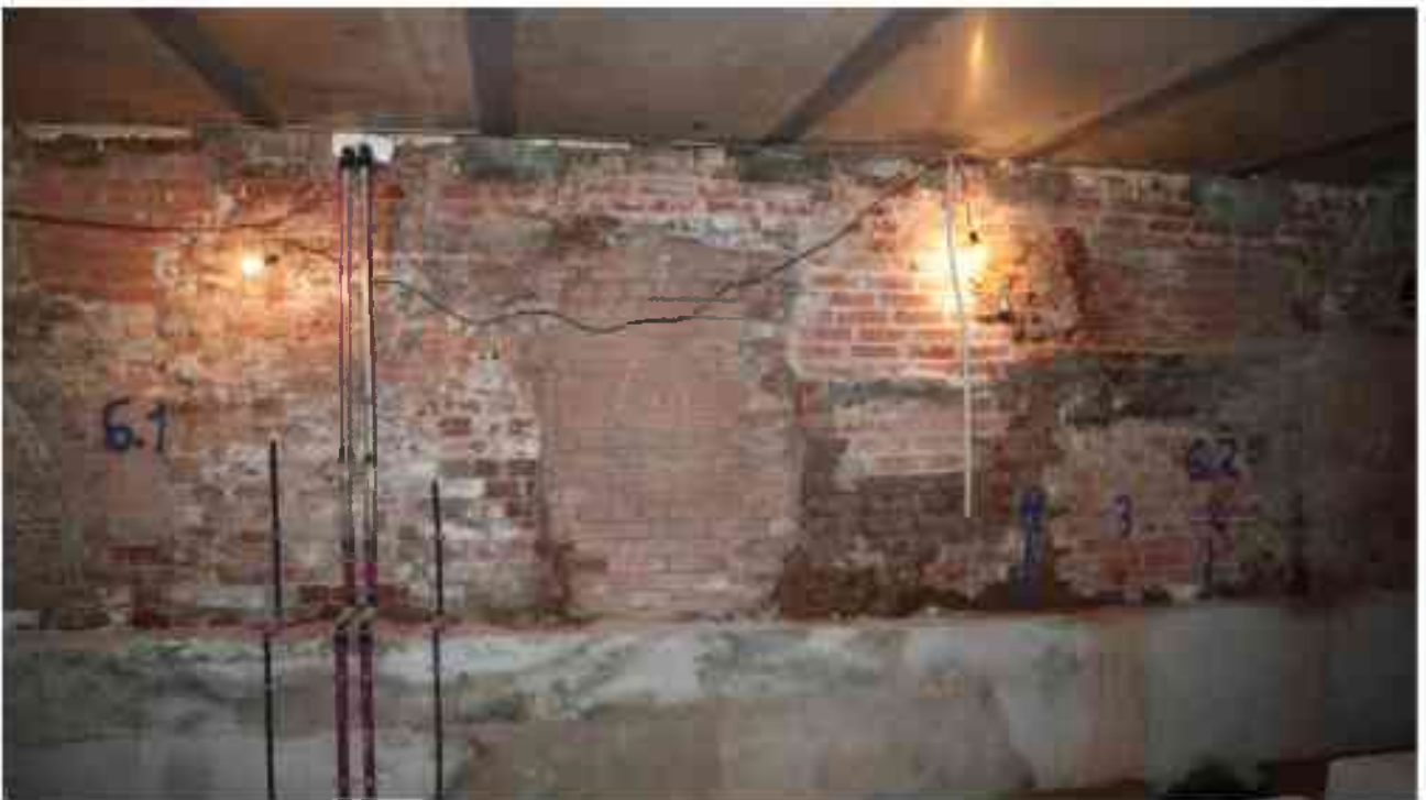
Фото п.232. Подвал, помещение 9Н (23-24).
