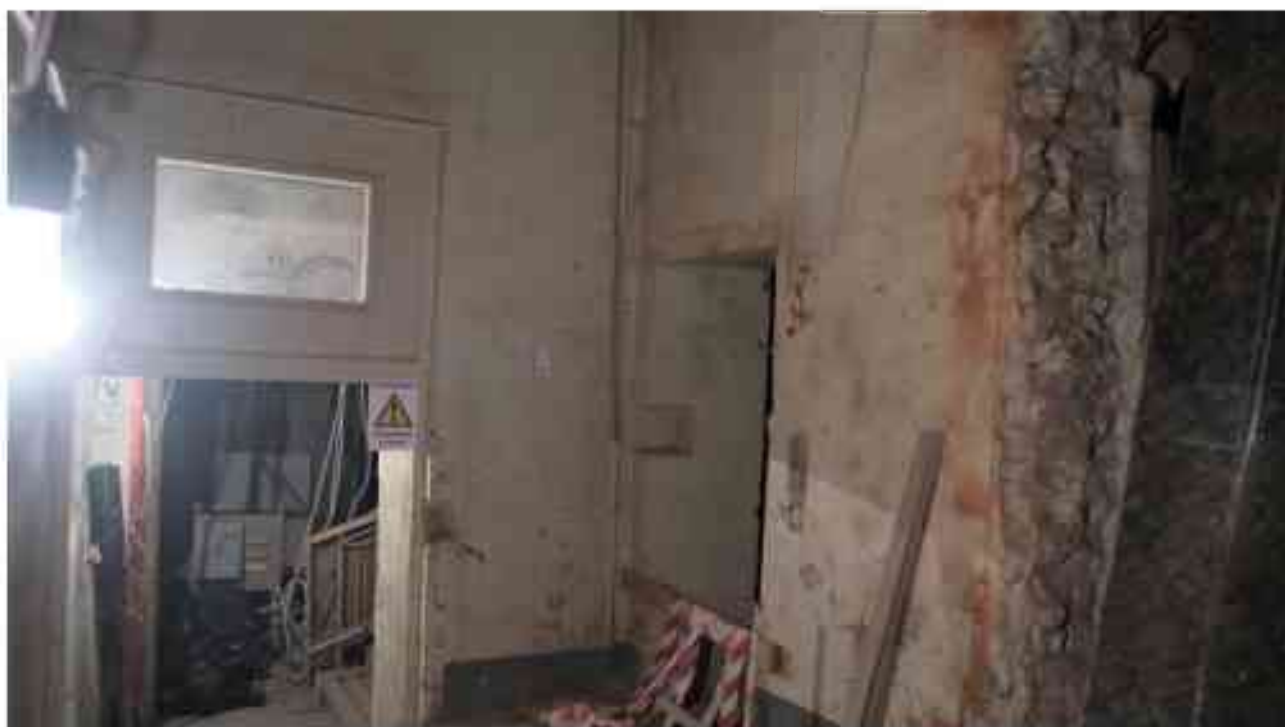
Фото 1.214. 1 этаж, помещение 15Н (1).
