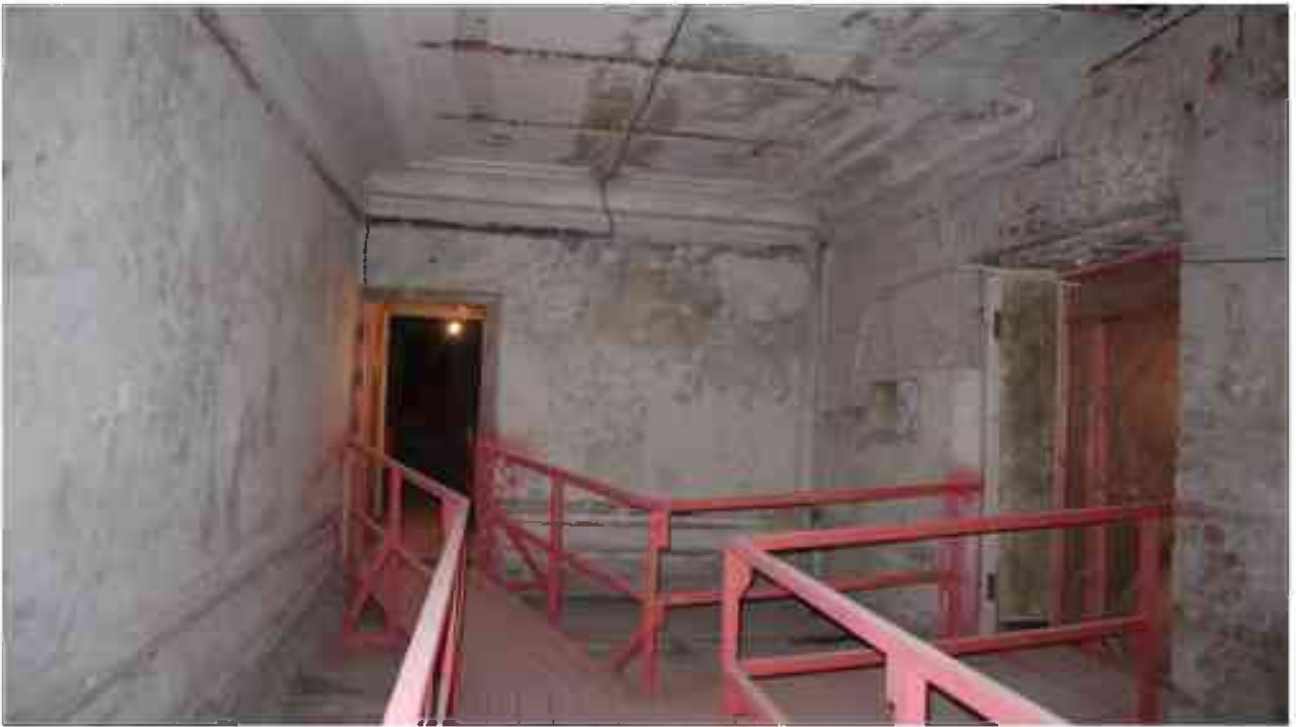
Фото 4.134. 4 этаж, помещение 30Н (1).
