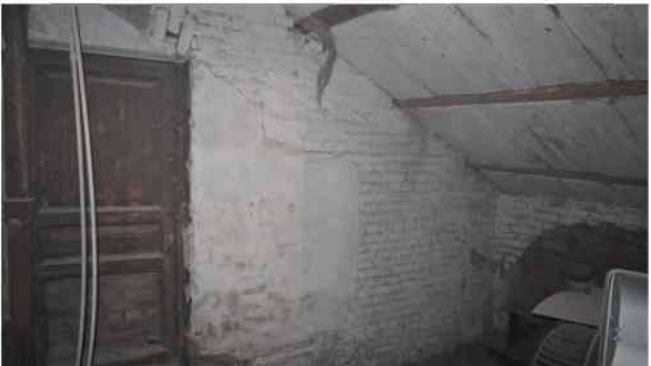
Фото 1.201. 1 этаж, помещение 11Н (4).
