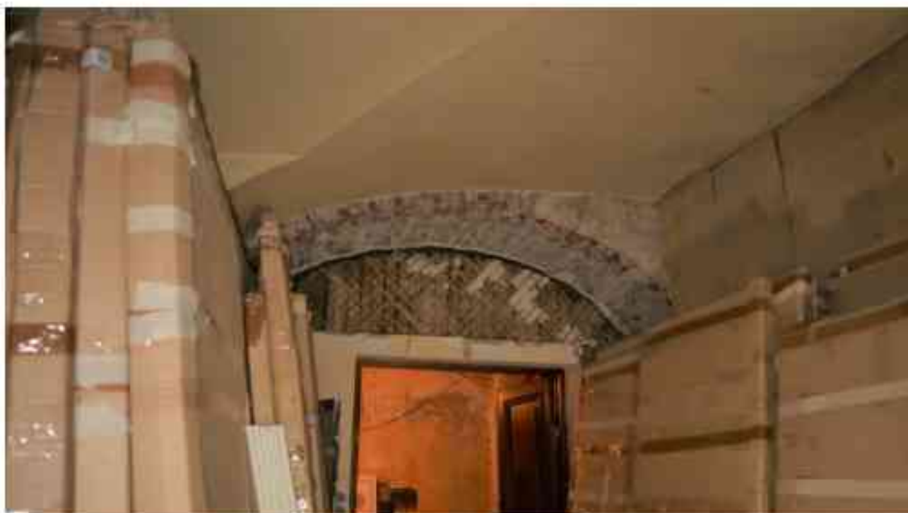
Фото 1.63. 1 этаж, помещение 14Н (13).
