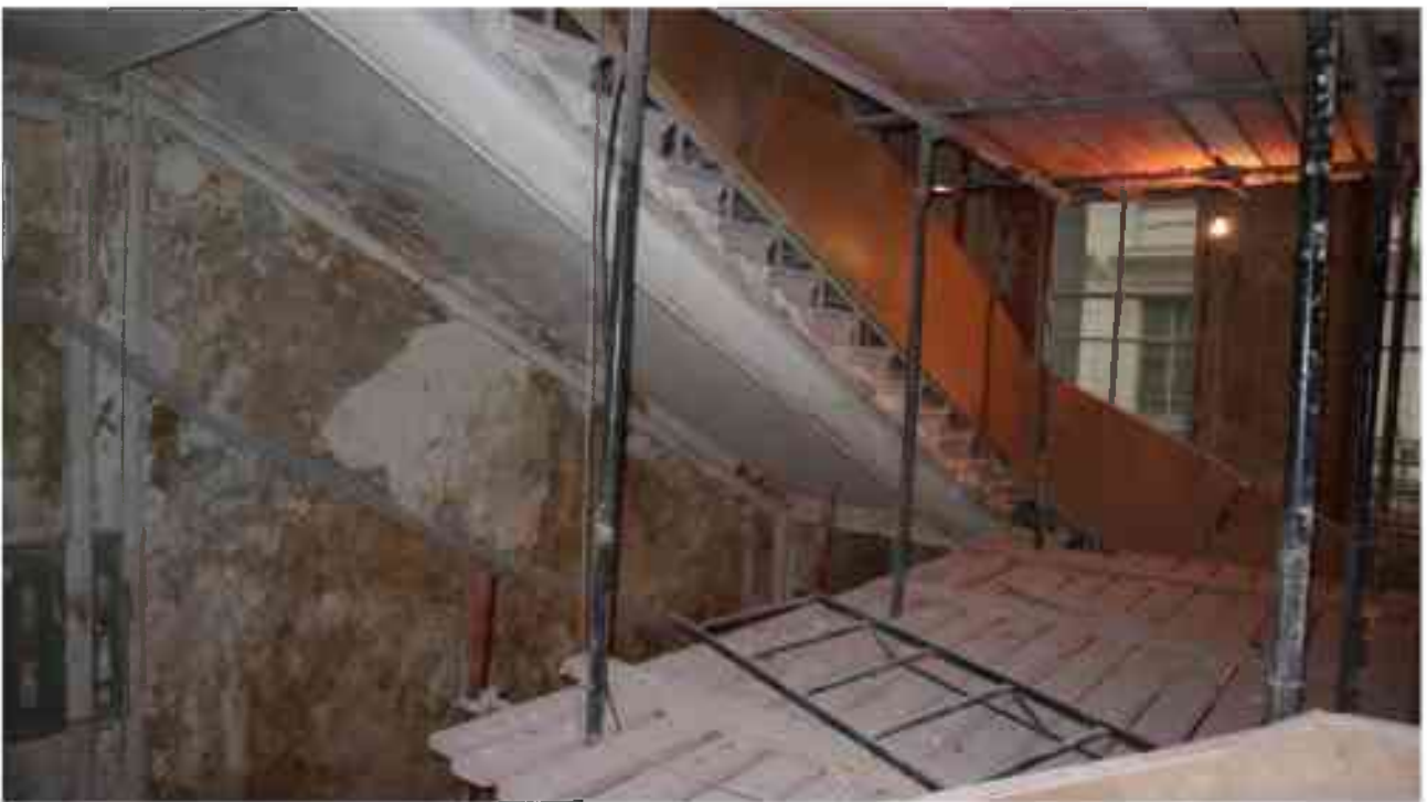
Фото 3.125. 3 этаж, лестница Л-13.
