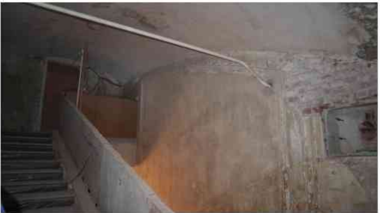
Фото 5.195. 5 этаж, лестница Л-21.
