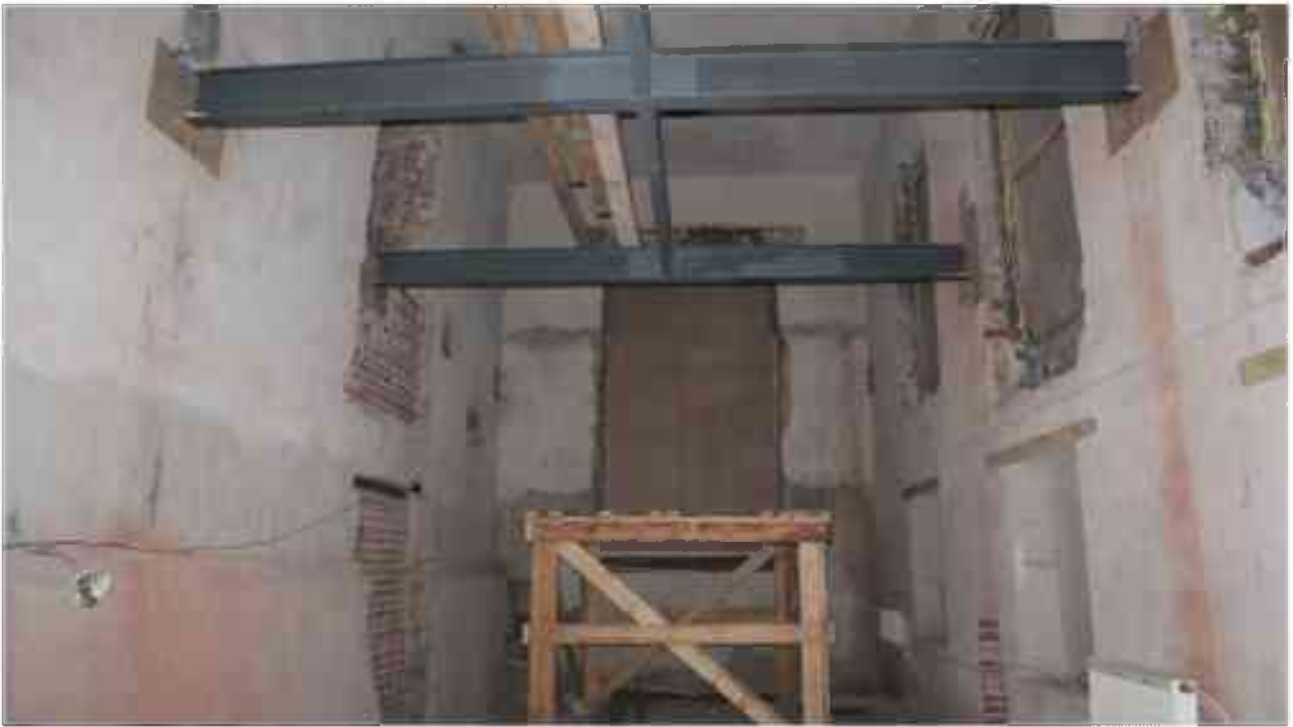
Фото п.330. Подвал, помещение 1Н (4-8).
