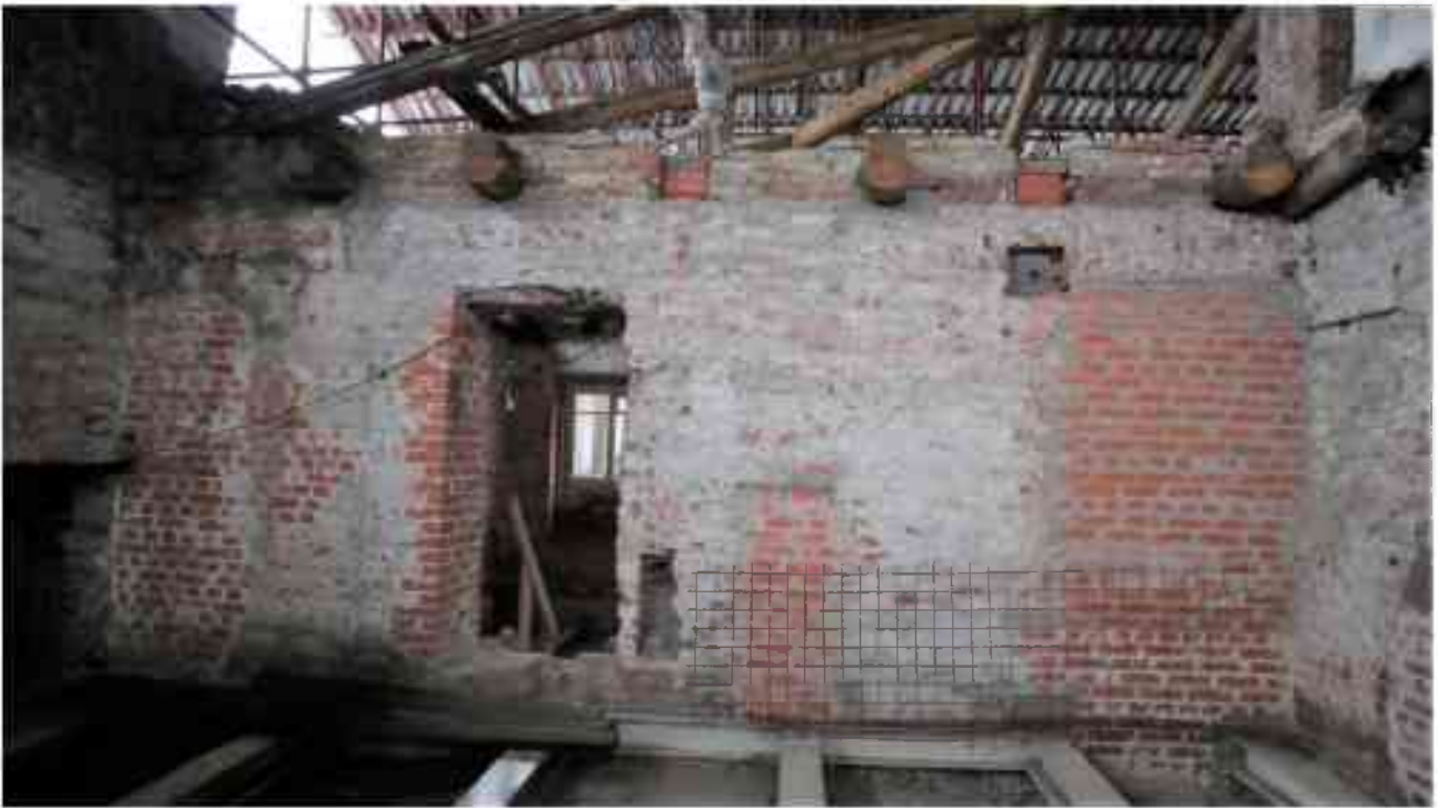
Фото 5.140. 5 этаж, жилой блок, на плане ПИБ 2000г. обозначен как квартиры, помещение (7-8).
