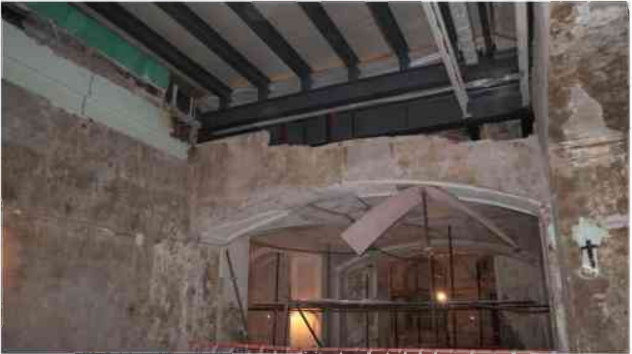
Фото 1.296. 1 этаж, помещение 13Н (35).
