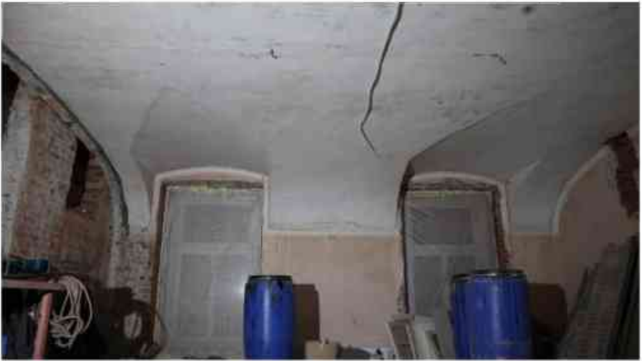
Фото 2.53. 2 этаж, помещение 22Н (50).
