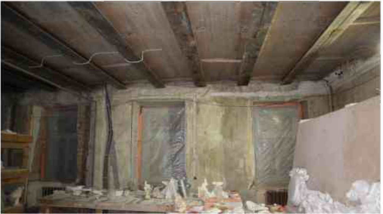
Фото 2.95. 2 этаж, помещение 22Н (33-35, 38-40).
