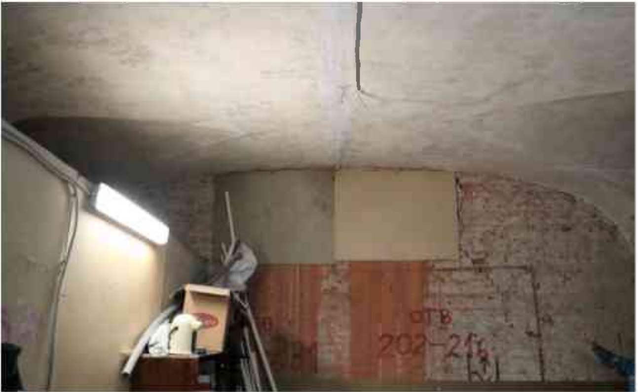
Фото 2.17. 2 этаж, помещение 22Н (47).
