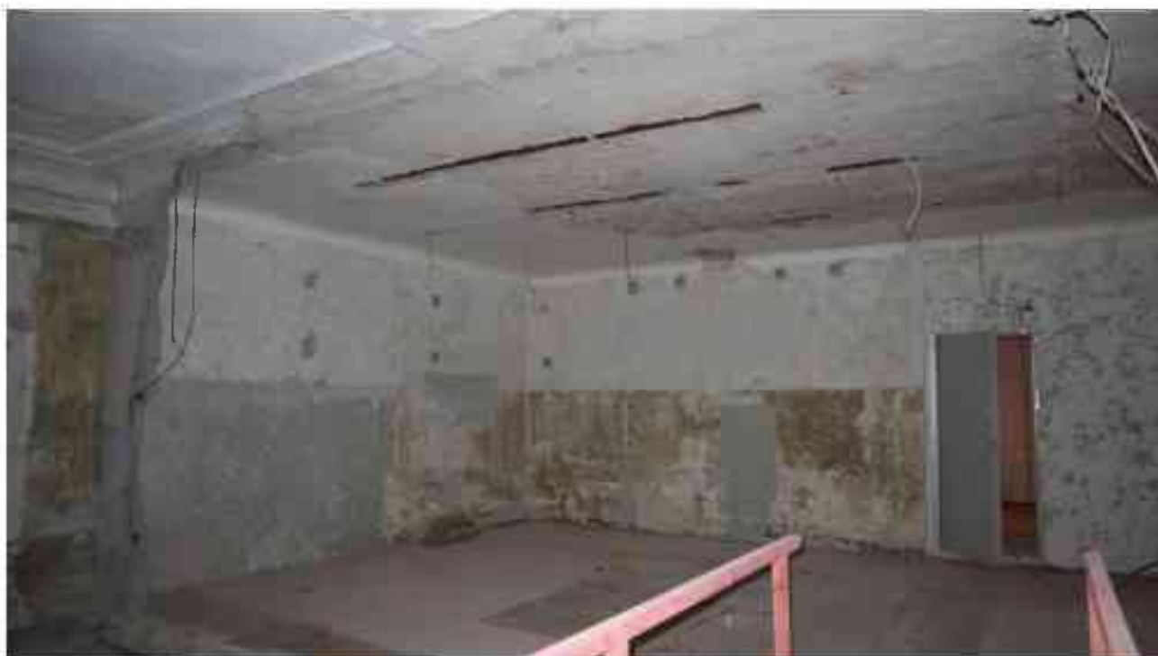
Фото 4.163. 4 этаж, помещение 30Н (6).
