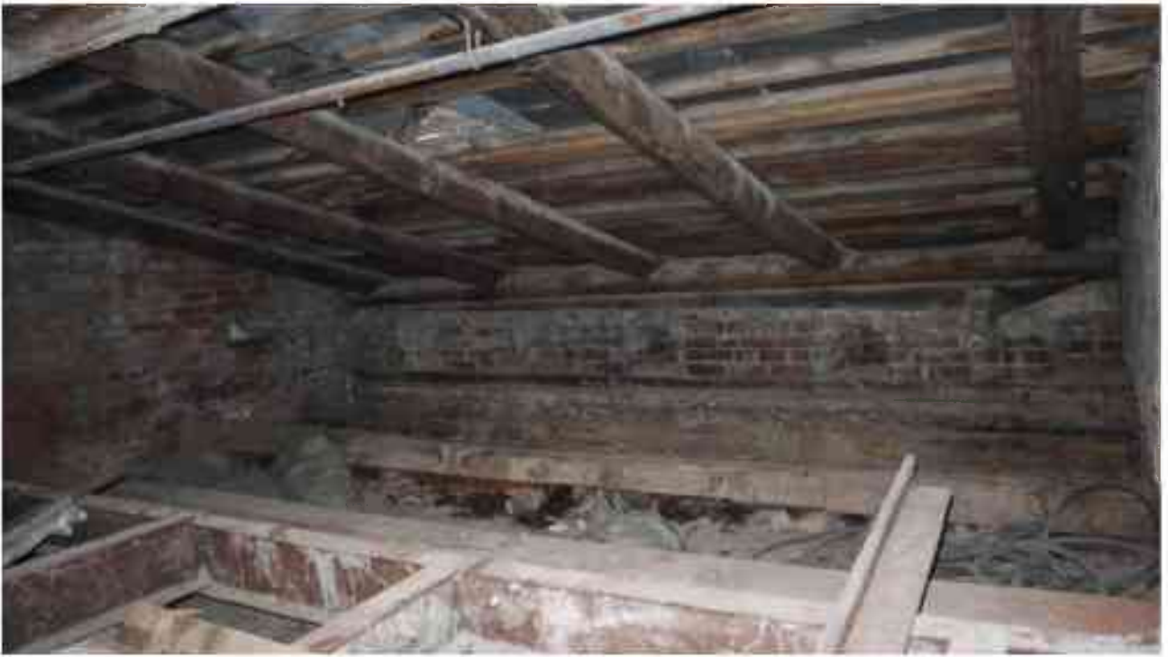
Фото 6.16. 6 этаж, чердачное помещение.
