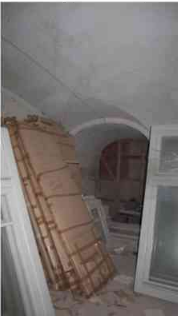
Фото 1.114. 1 этаж, помещение 14Н (30-34).
