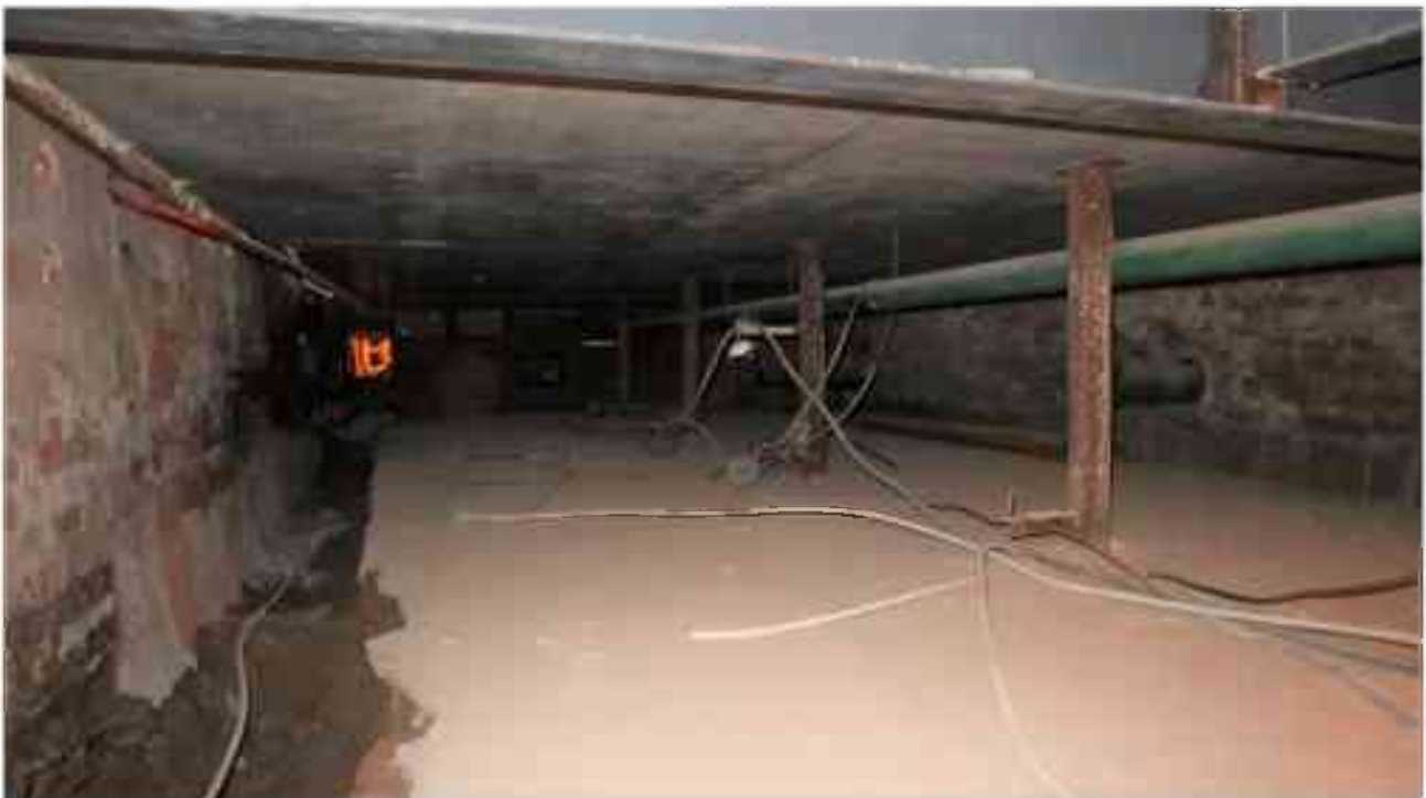
Фото п.302. Подвал, помещение 3Н (16).
