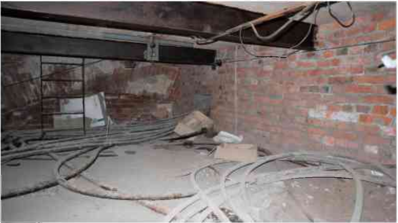
Фото п.344. Подвал, помещение 2Н (6).
