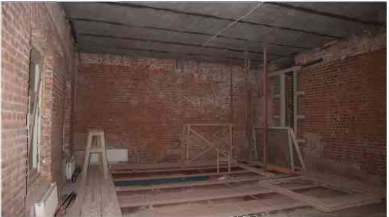
Фото 4.68. 4 этаж, помещение 33Н (51).
