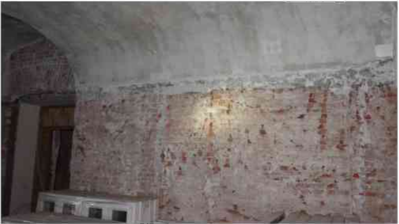
Фото 2.108. 2 этаж, помещение 22Н (44).
