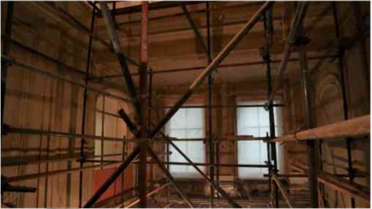
Фото 3.63. 3 этаж, лестница Л-14.
