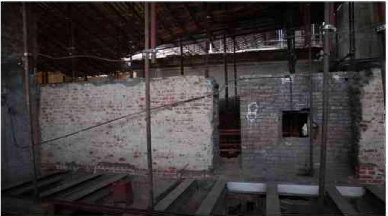
Фото 5.175. 5 этаж, чердачное помещение.
