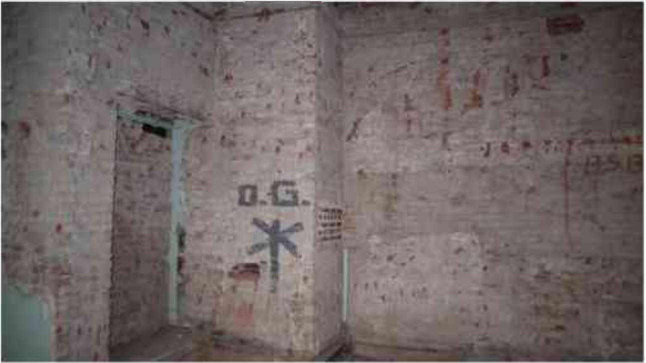
Фото 5.67. 5 этаж, помещение 35Н (4-6).
