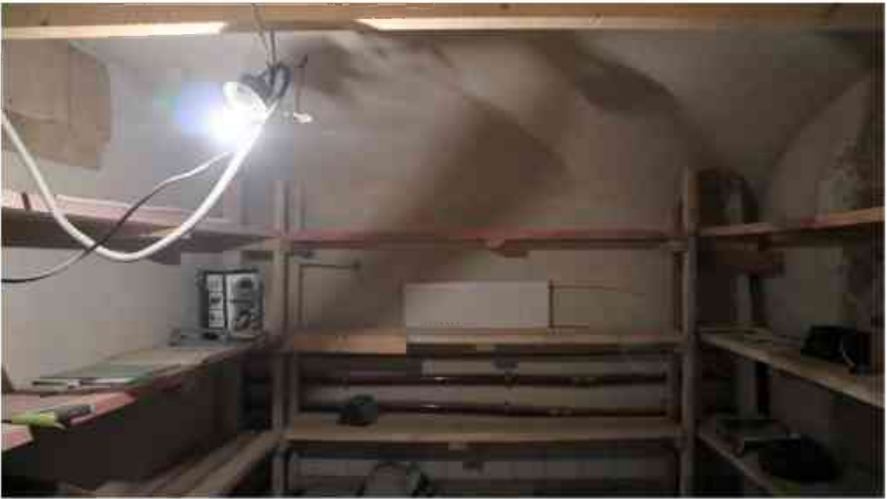
Фото п.156. Подвал, западная часть помещения 9Н (13), разделенного перегородкой.
