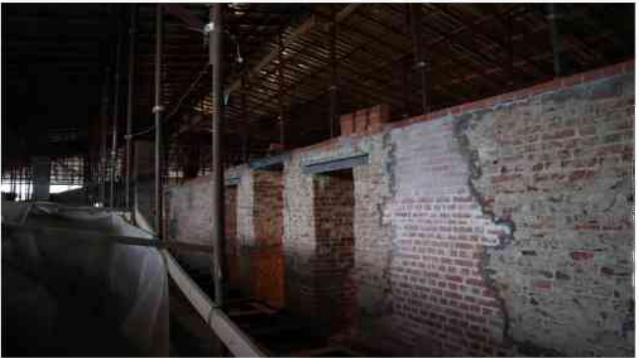
Фото 5.163. 5 этаж, чердачное помещение.
