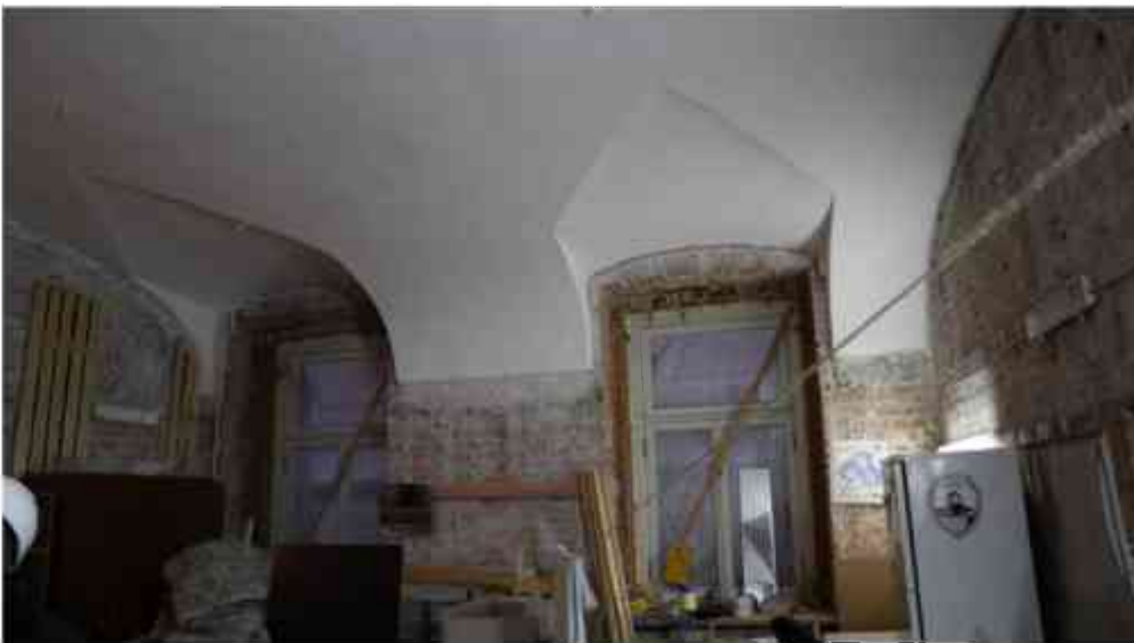
Фото 2.44. 2 этаж, помещение 22Н (53).
