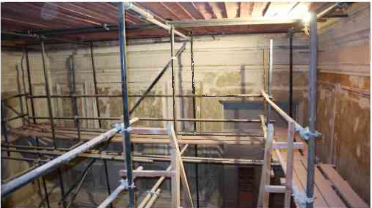
Фото 2.134. 2 этаж, помещение 22Н (18).*
