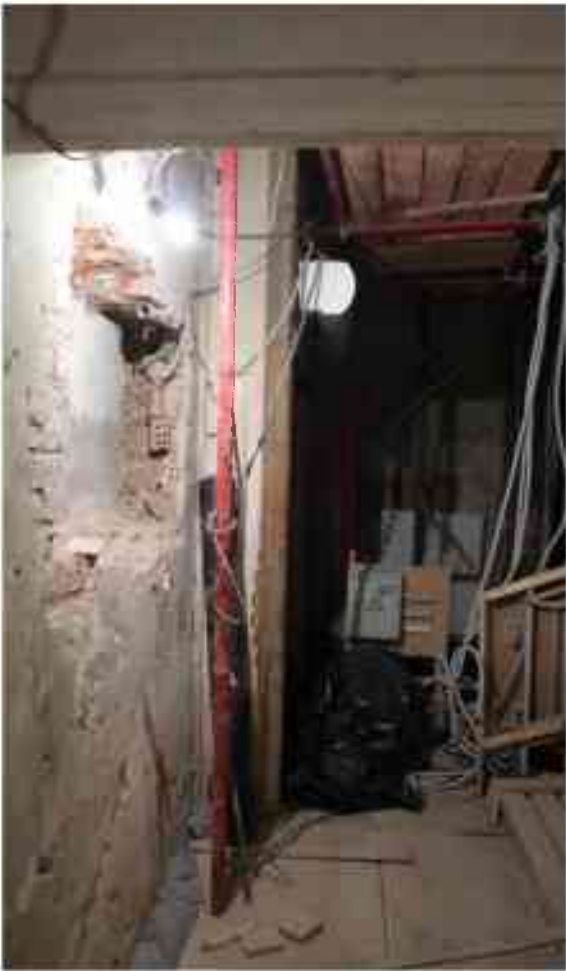
Фото 1.221. 1 этаж, лестница Л-7.
