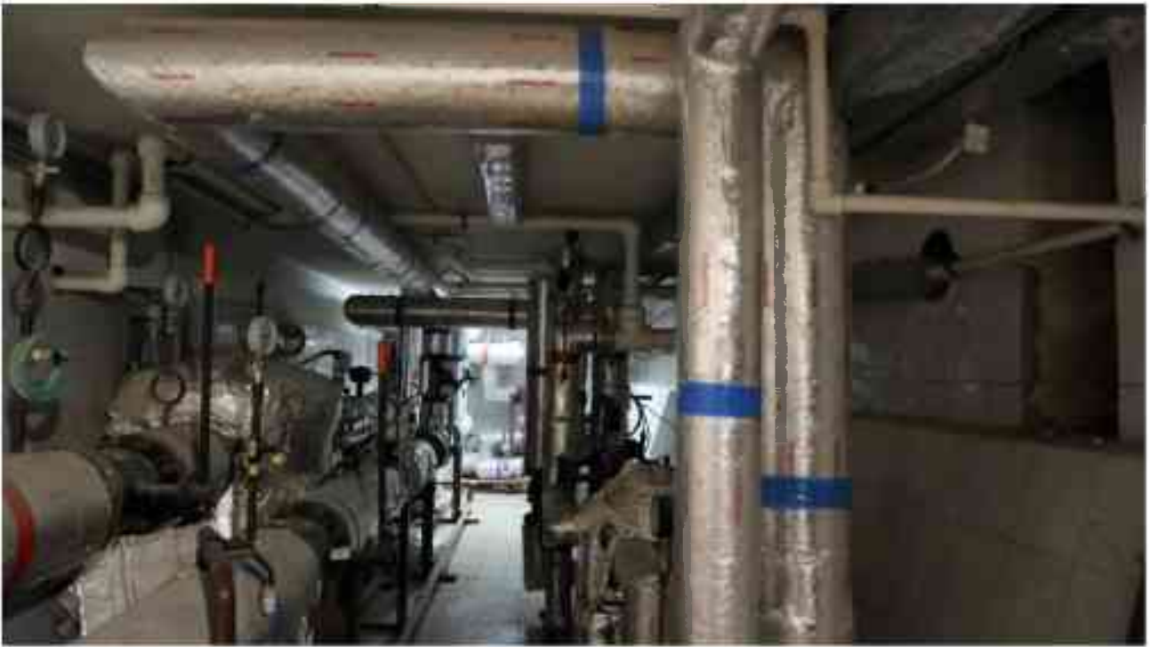
Фото п.320. Подвал, помещение 18Н (1-2, 8).
