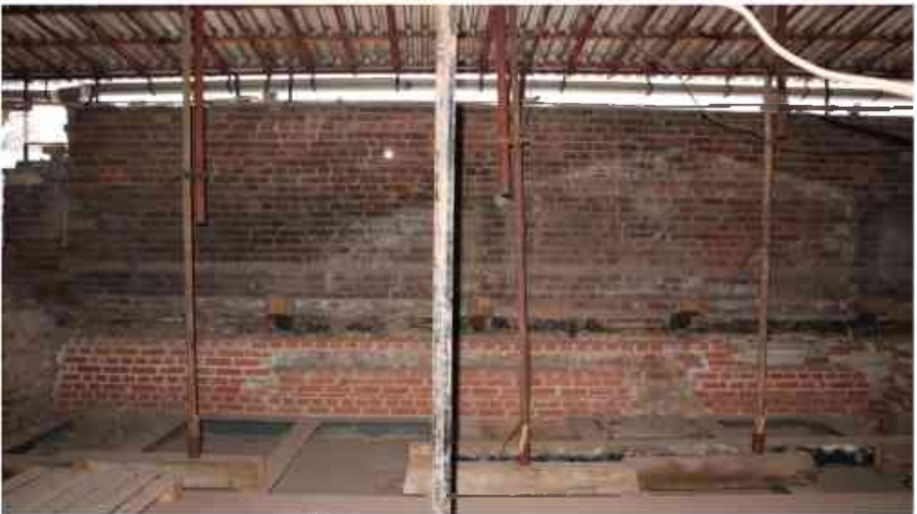
Фото 5.191. 5 этаж, чердачное помещение.
