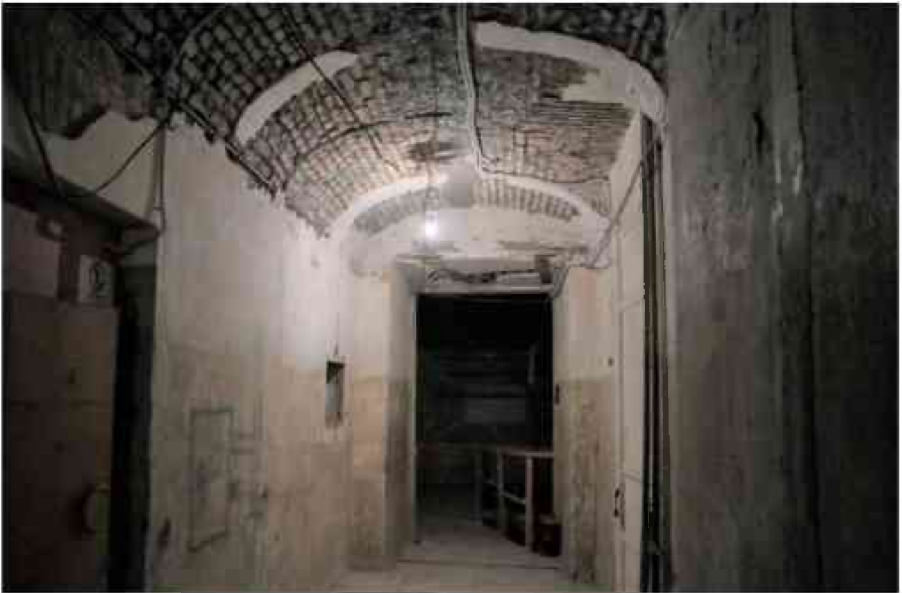
Фото 2.61. 2 этаж, помещение 22Н (32).
