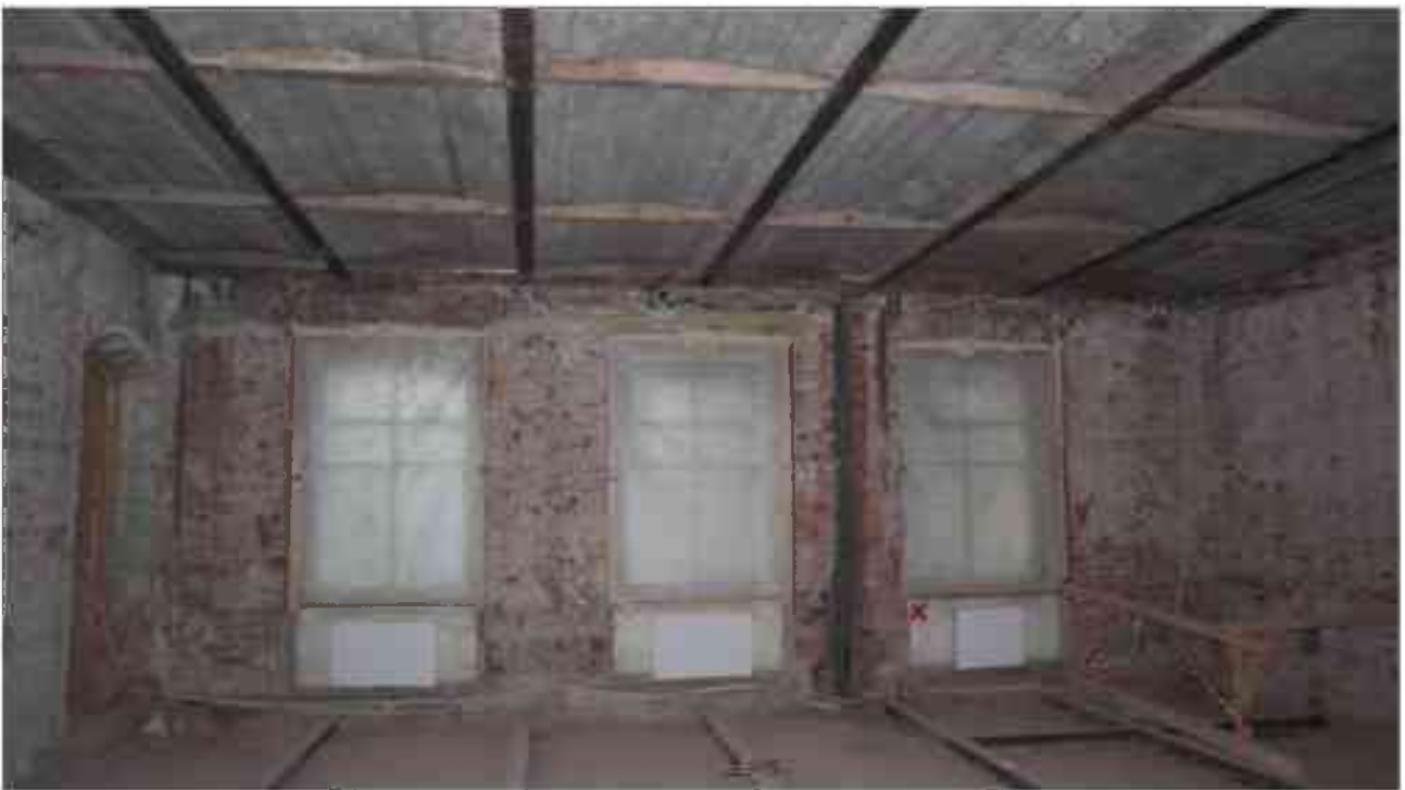
Фото 4.27. 4 этаж, помещение 33Н (33).
