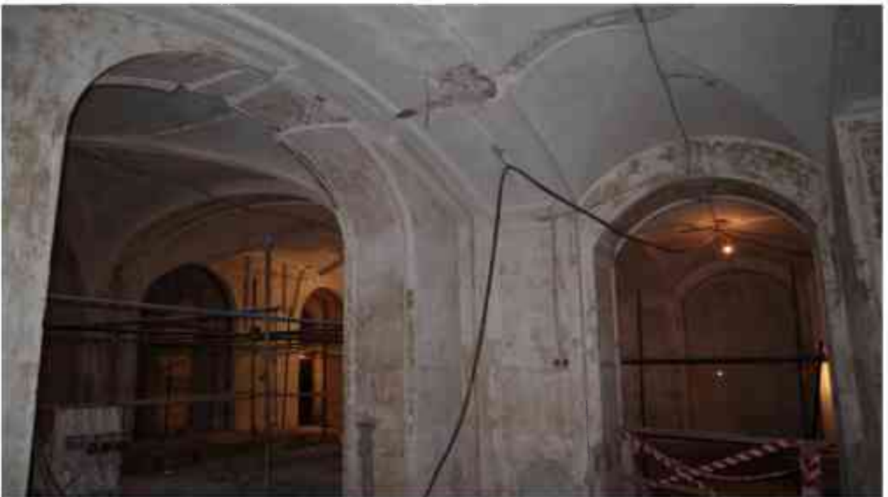
Фото 1.285. 1 этаж, помещение 13Н (4).
