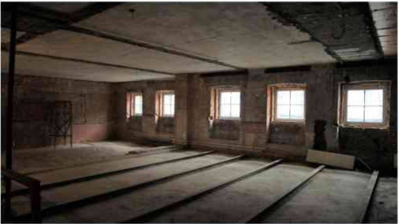
Фото 5.90. 5 этаж, помещение 34Н(3-11).
