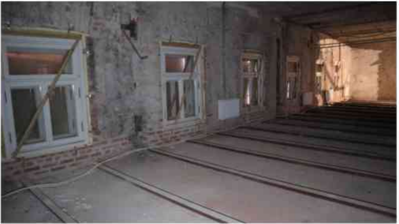
Фото 3.157. 3 этаж, помещение 23Н (1-6).
