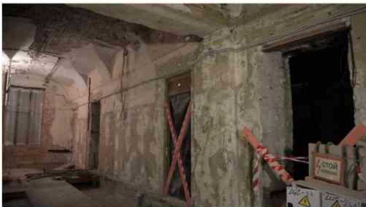
Фото 2.201. 2 этаж, помещение 22Н (10).
