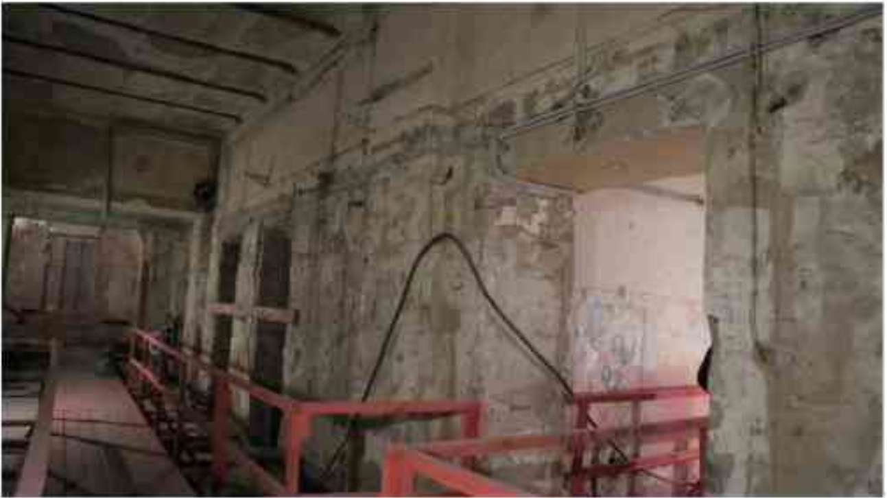
Фото 2.189. 2 этаж, помещение 22Н (10).
