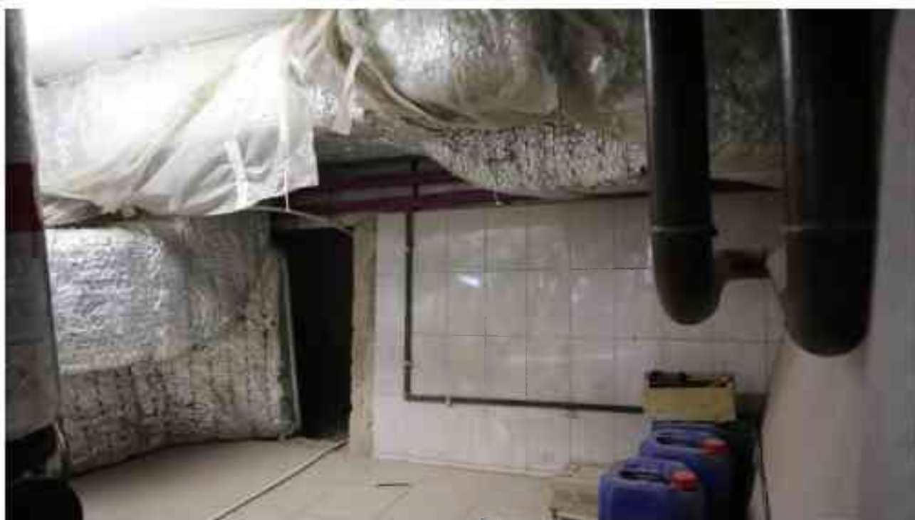
Фото п.329. Подвал, помещение 18Н (10-12).
