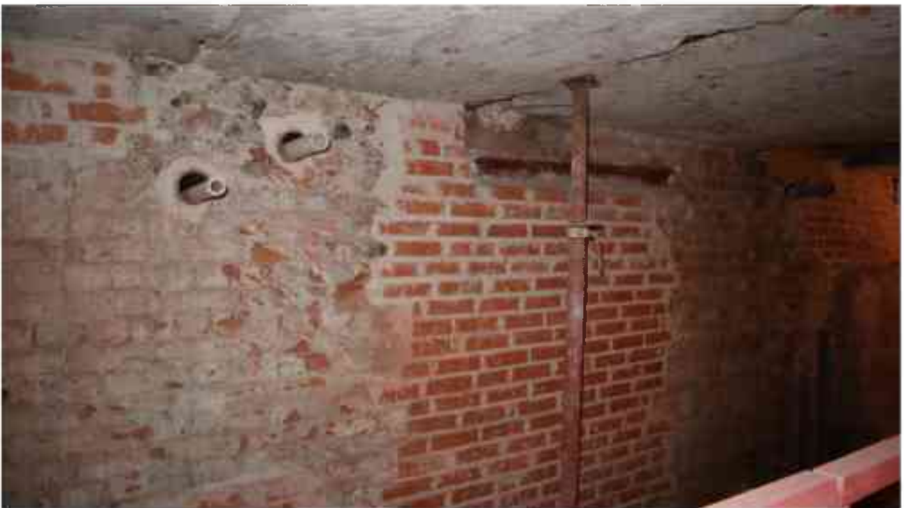
Фото п.339. Подвал, помещение 18Н (3-4).
