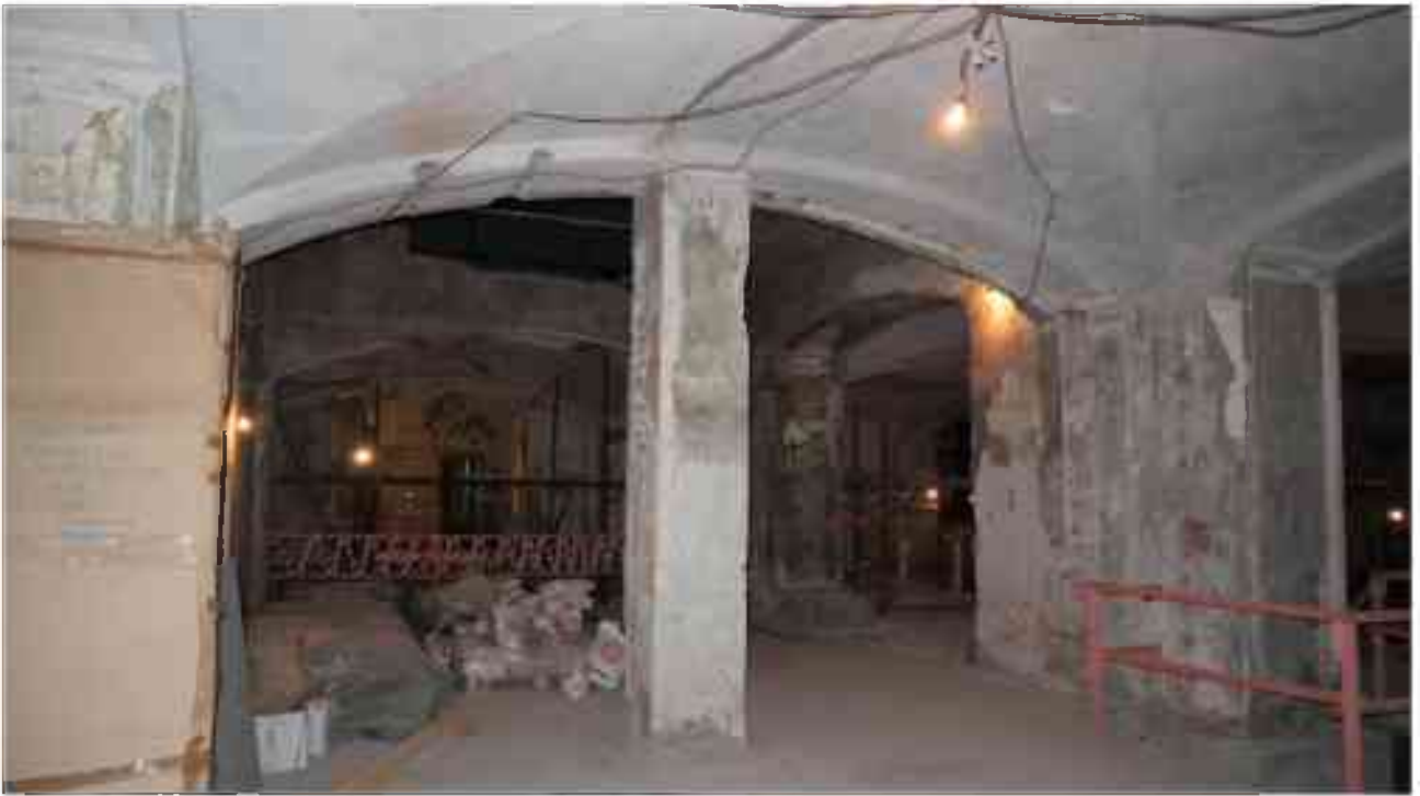
Фото 1.294. 1 этаж, помещение 13Н (4).
