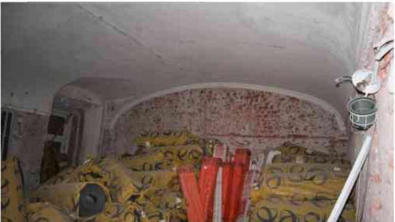
Фото 1.144. 1 этаж, помещение 31Н (9-10).
