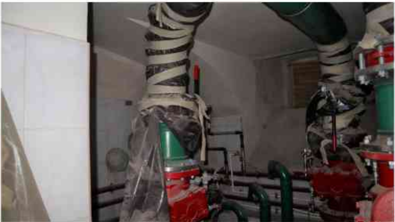
Фото п.171. Подвал, помещение 9Н (9).
