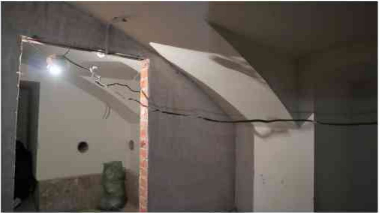
Фото п.218. Подвал, помещение 9Н (4).
