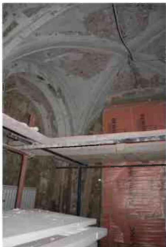
Фото 1.257. 1 этаж, помещение 13Н (15-16).
