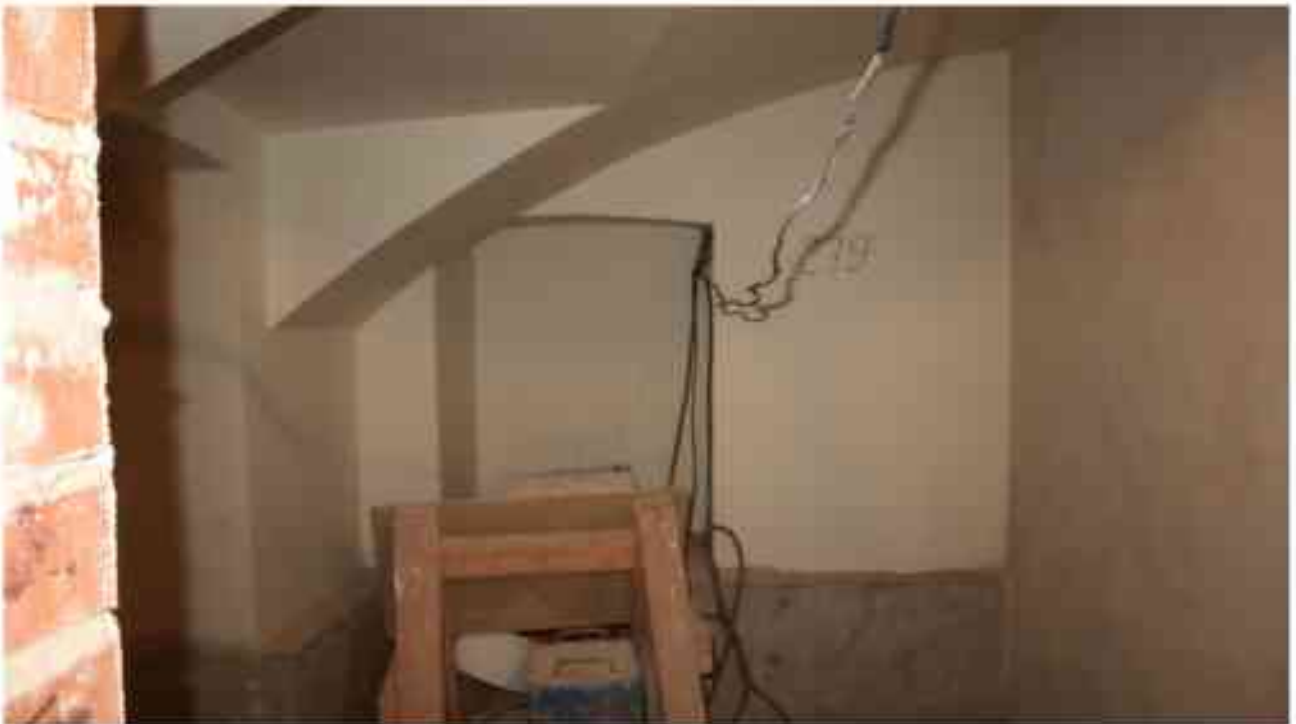
Фото п.217. Подвал, помещение 9Н (4).
