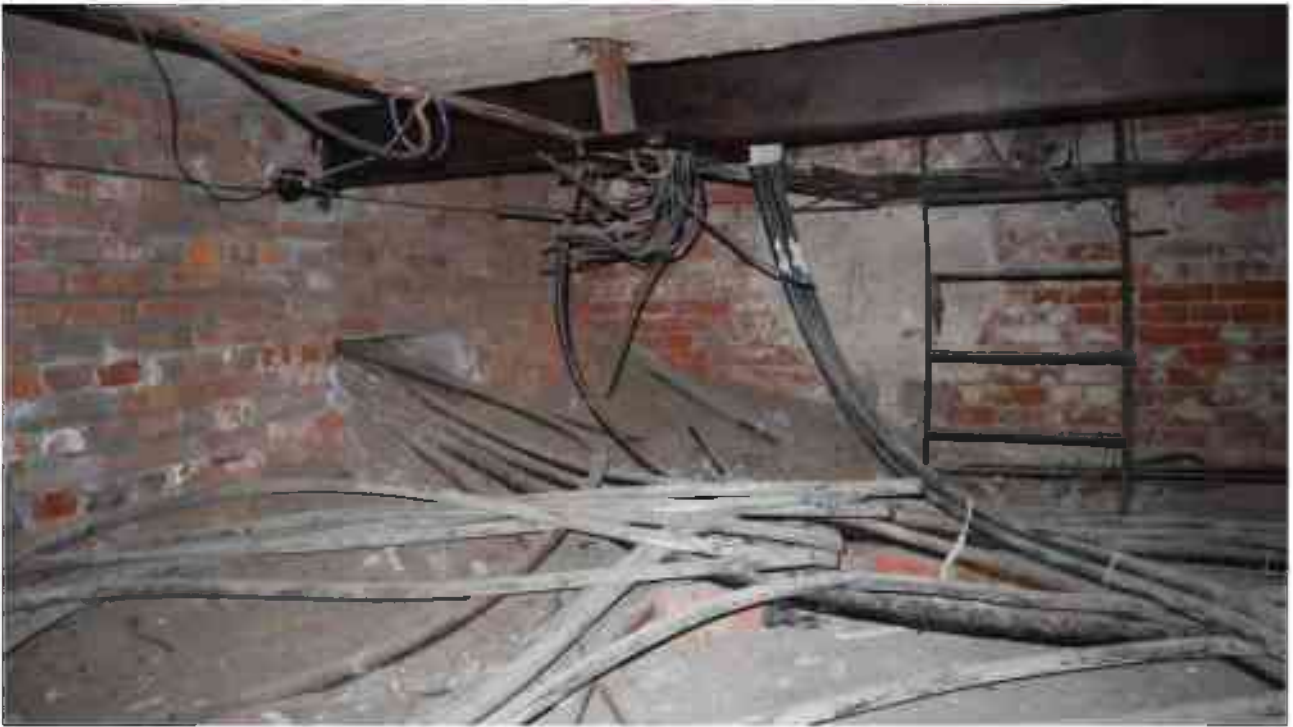
Фото п.346. Подвал, помещение 2Н (6).
