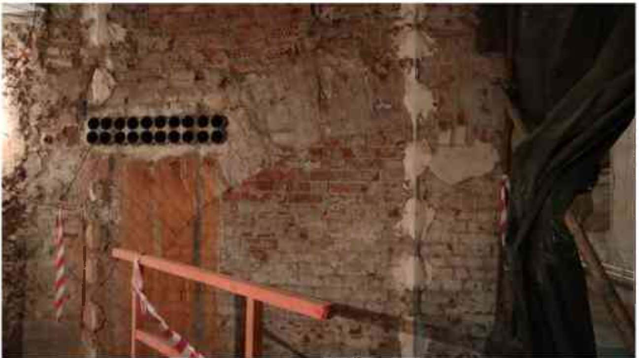
Фото п.54. Подвал, помещение 3Н (14).
