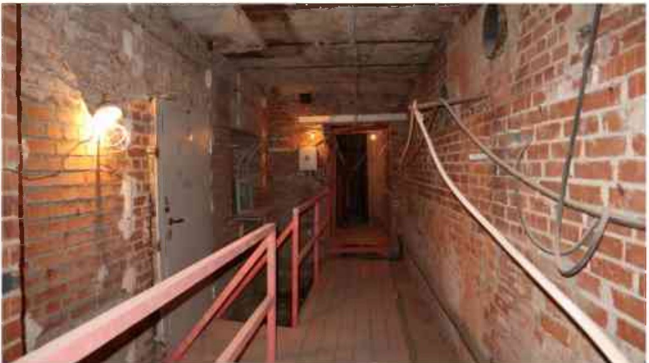
Фото п.20. Подвал, помещение 3Н (9).
