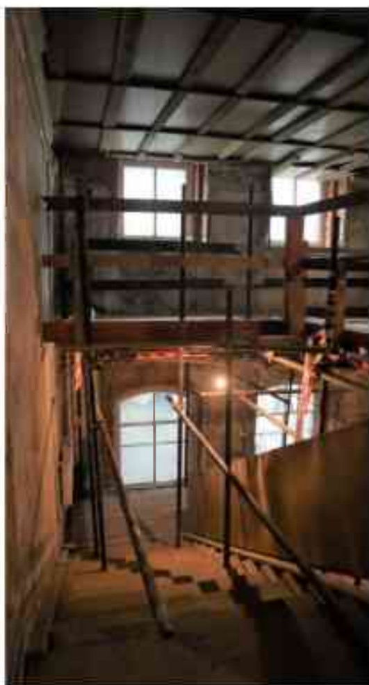
Фото 5.85. 5 этаж, лестница Л-13.
