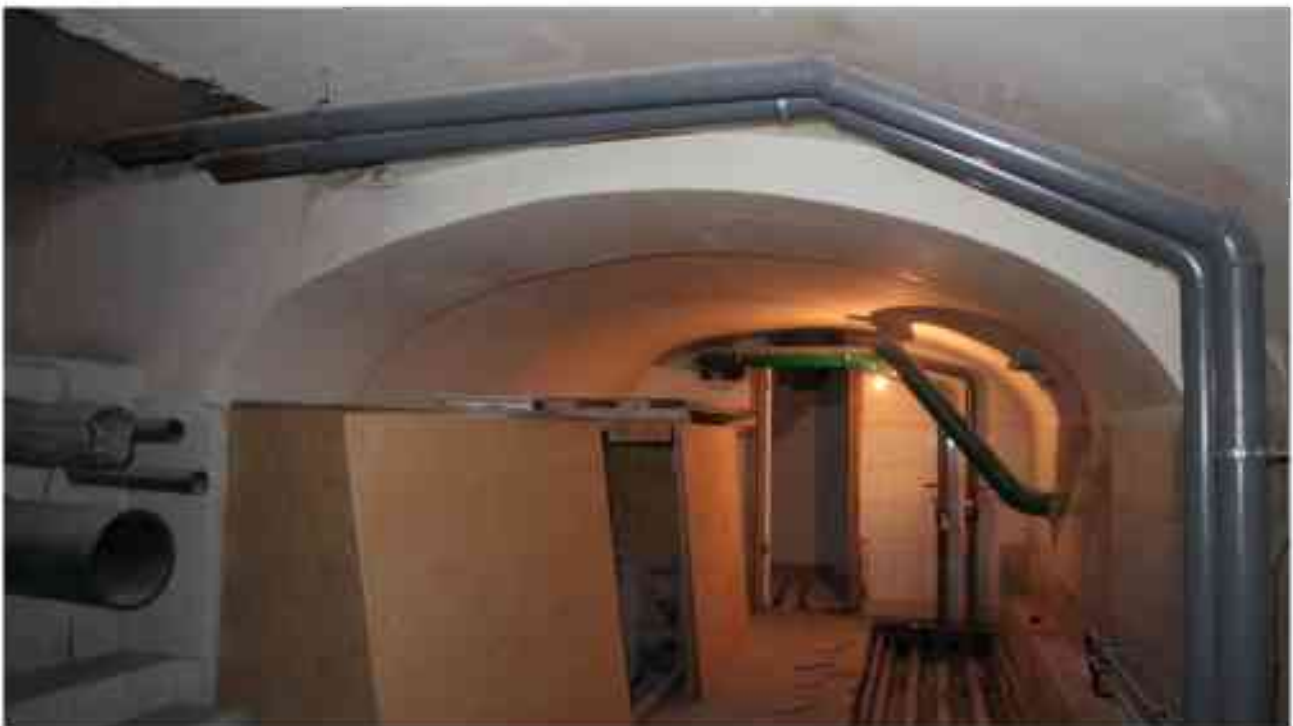
Фото п.180. Подвал, помещение 9Н (8).
