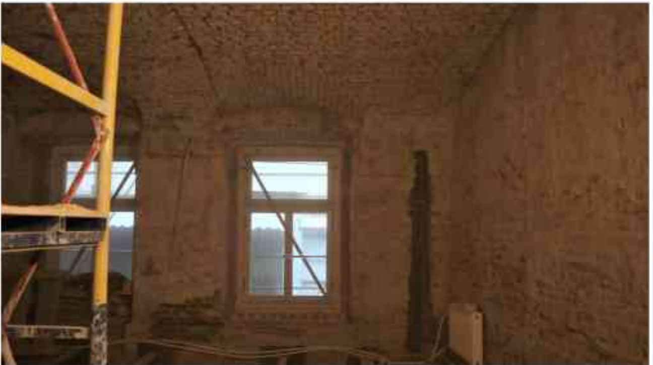
Фото 1.196. 1 этаж, помещение 11Н (1-3, 5).
