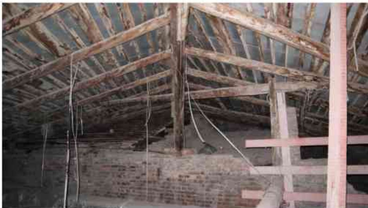
Фото 6.68. 6 этаж, чердачное помещение.
