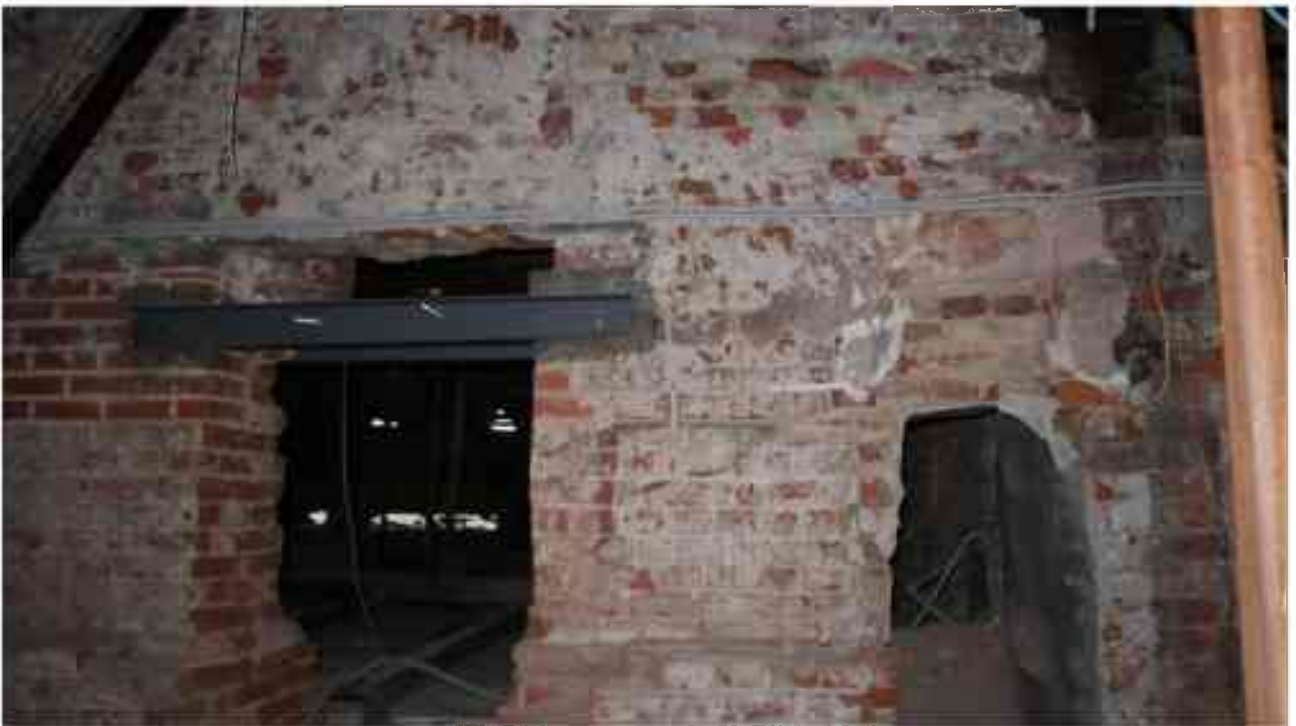
Фото 5.121. 5 этаж, коридор, помещения 34Н/37Н.
