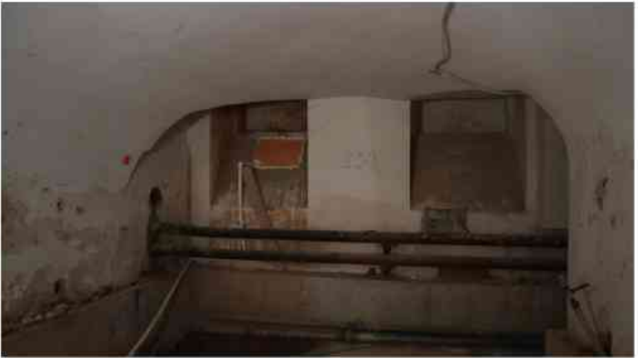
Фото п.98. Подвал, помещение 8Н (8).
