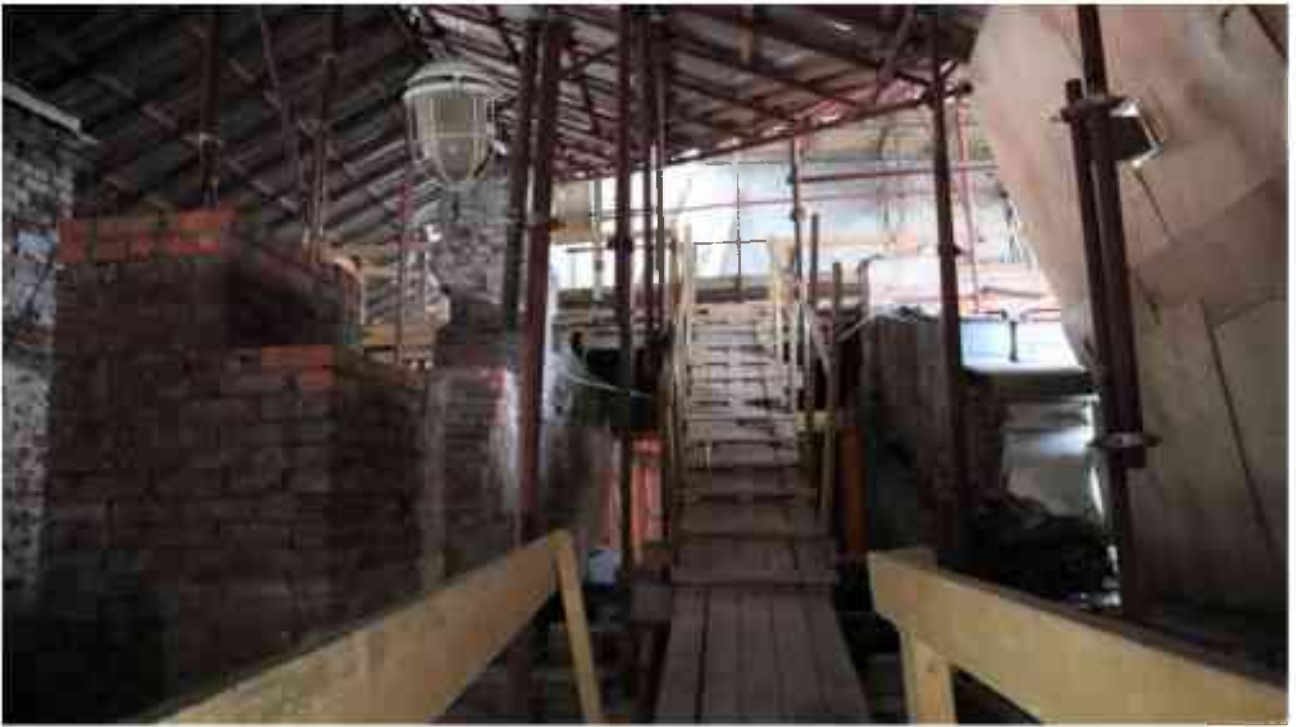
Фото 6.32. 6 этаж, чердачное помещение.
