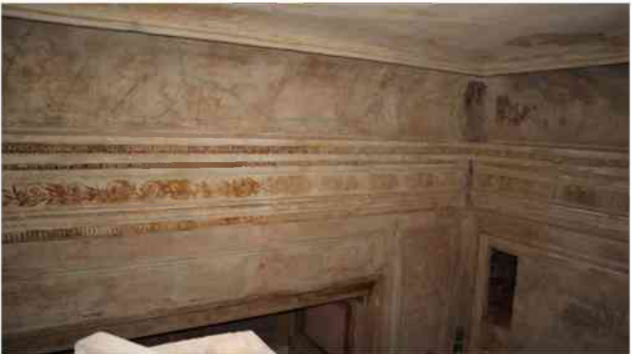
Фото 2.74. 2 этаж, помещение 22Н (31).*
