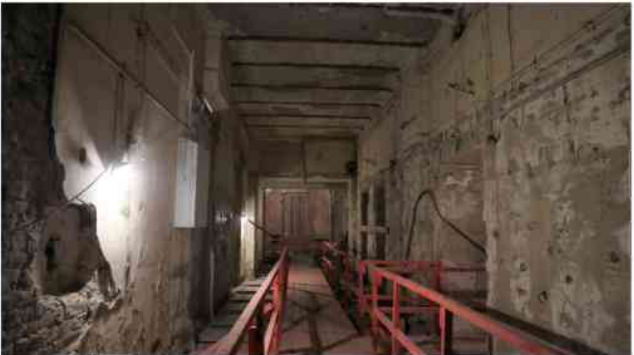
Фото 2.188. 2 этаж, помещение 22Н (10).
