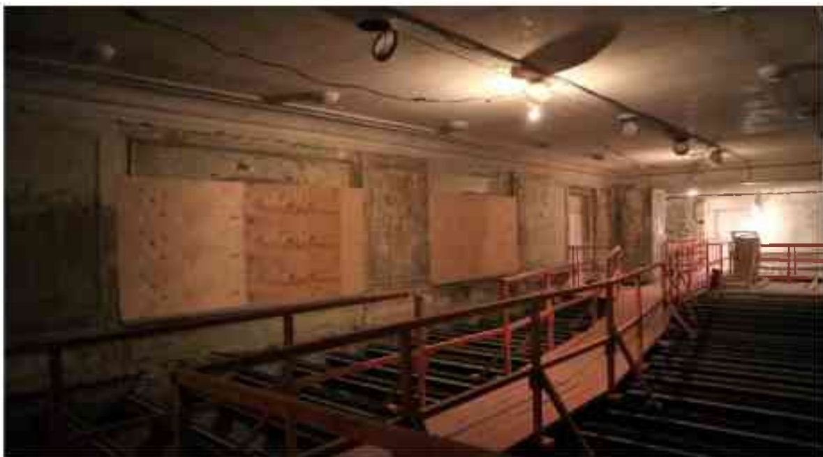
Фото 4.150. 4 этаж, помещение 30Н (5).
