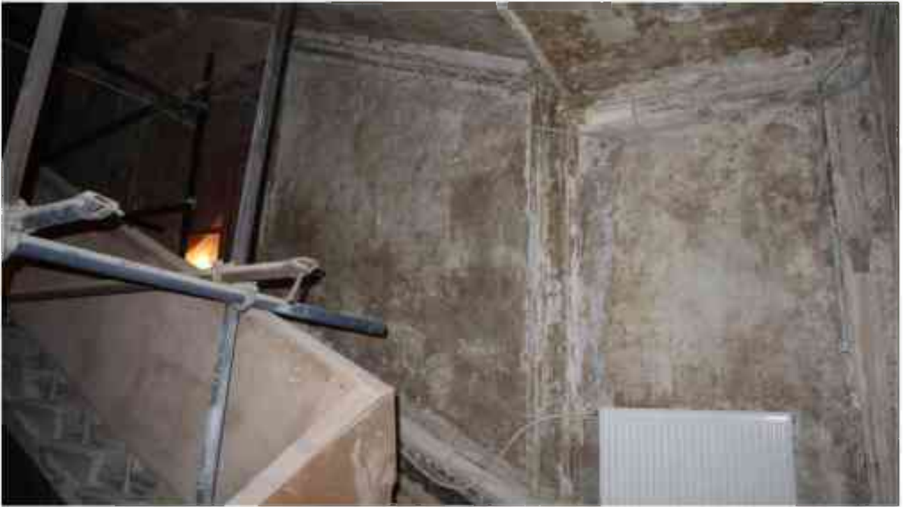
Фото 3.111. 3 этаж, лестница Л-10.
