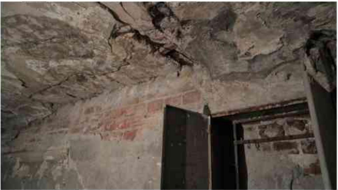
Фото 5.107. 5 этаж, лестница в ризалите южного фасада (западная часть).*
