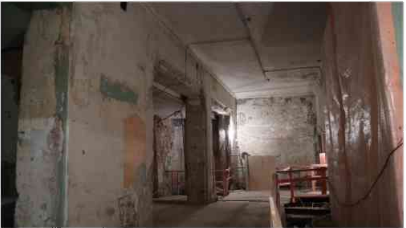
Фото 1.311. 1 этаж, помещение 13Н (1).
