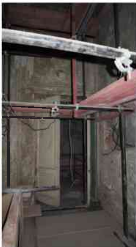
Фото 4.171. 4 этаж, лестница с перекрестными маршами, трехмаршевая, в центре здания.*
