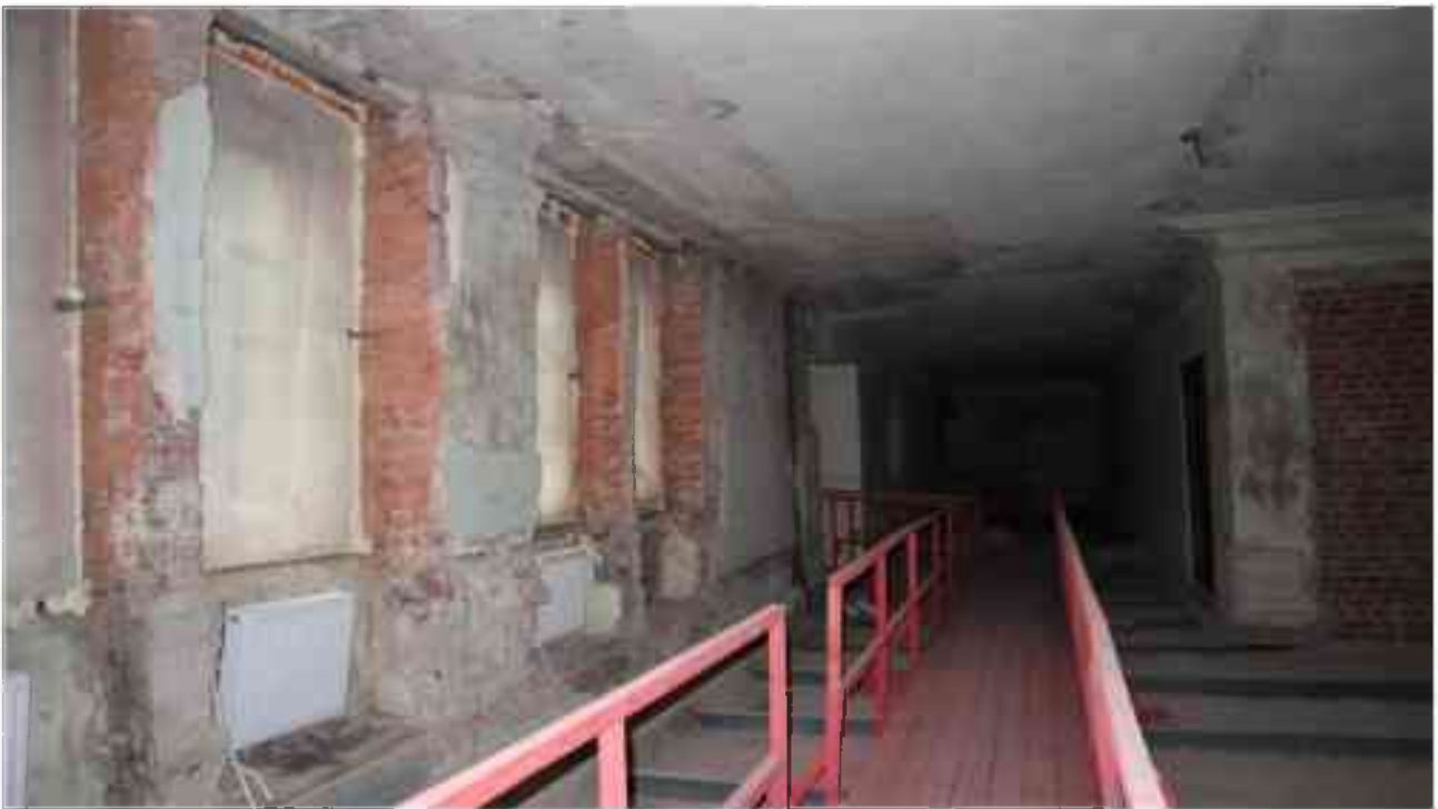
Фото 4.166. 4 этаж, помещение 30Н (7).
