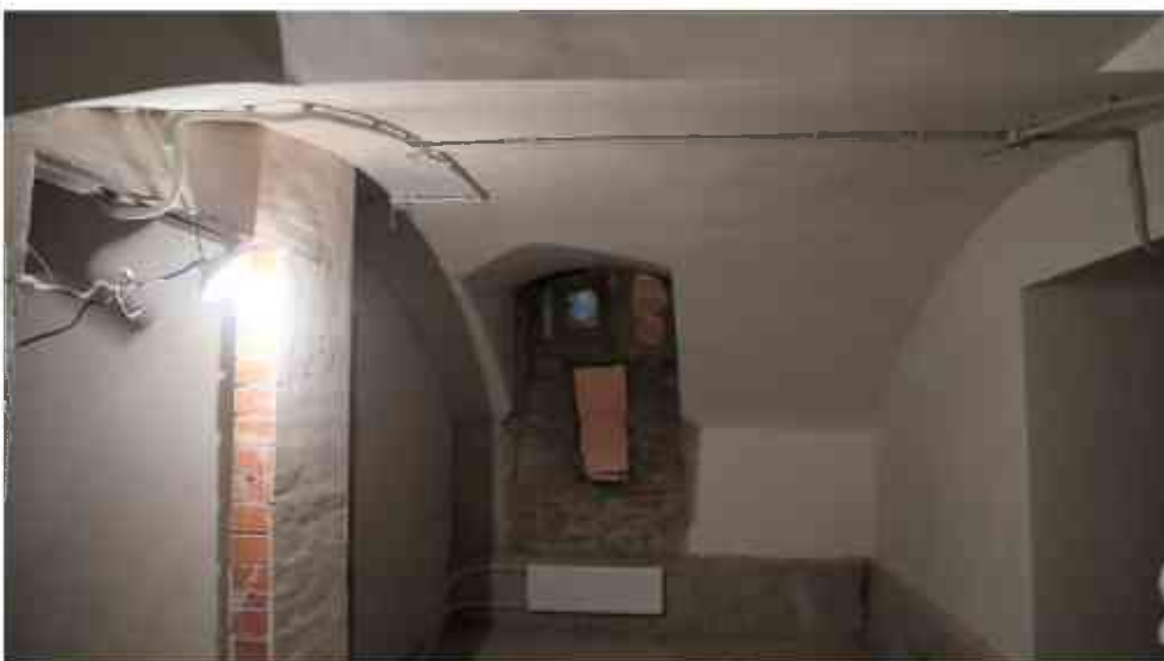
Фото п.211. Подвал, помещение 9Н (4).
