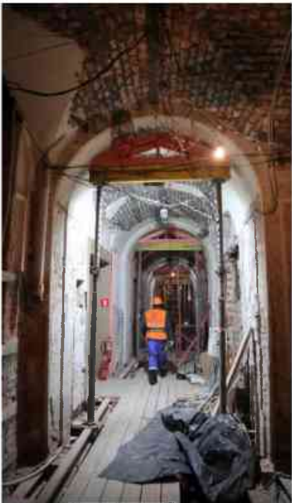
Фото 2.43. 2 этаж, помещение 22Н (60).
