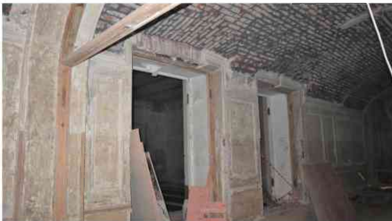
Фото 4.33. 4 этаж, помещение 33Н (30).
