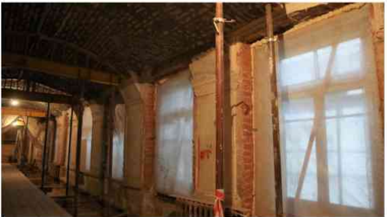
Фото 4.58. 4 этаж, коридор, помещение 33Н (22).
