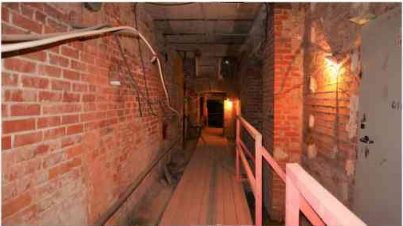
Фото п.23. Подвал, помещение 3Н (9).
