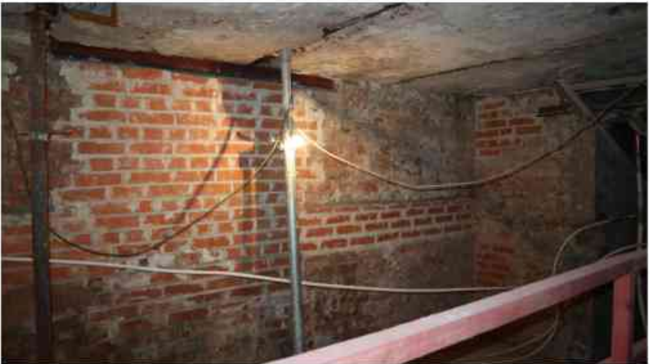
Фото п.337. Подвал, помещение 18Н (3-4).
