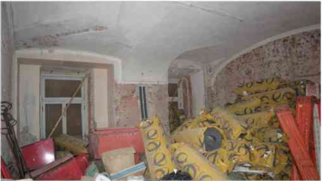
Фото 1.143. 1 этаж, помещение 31Н (9-10).
