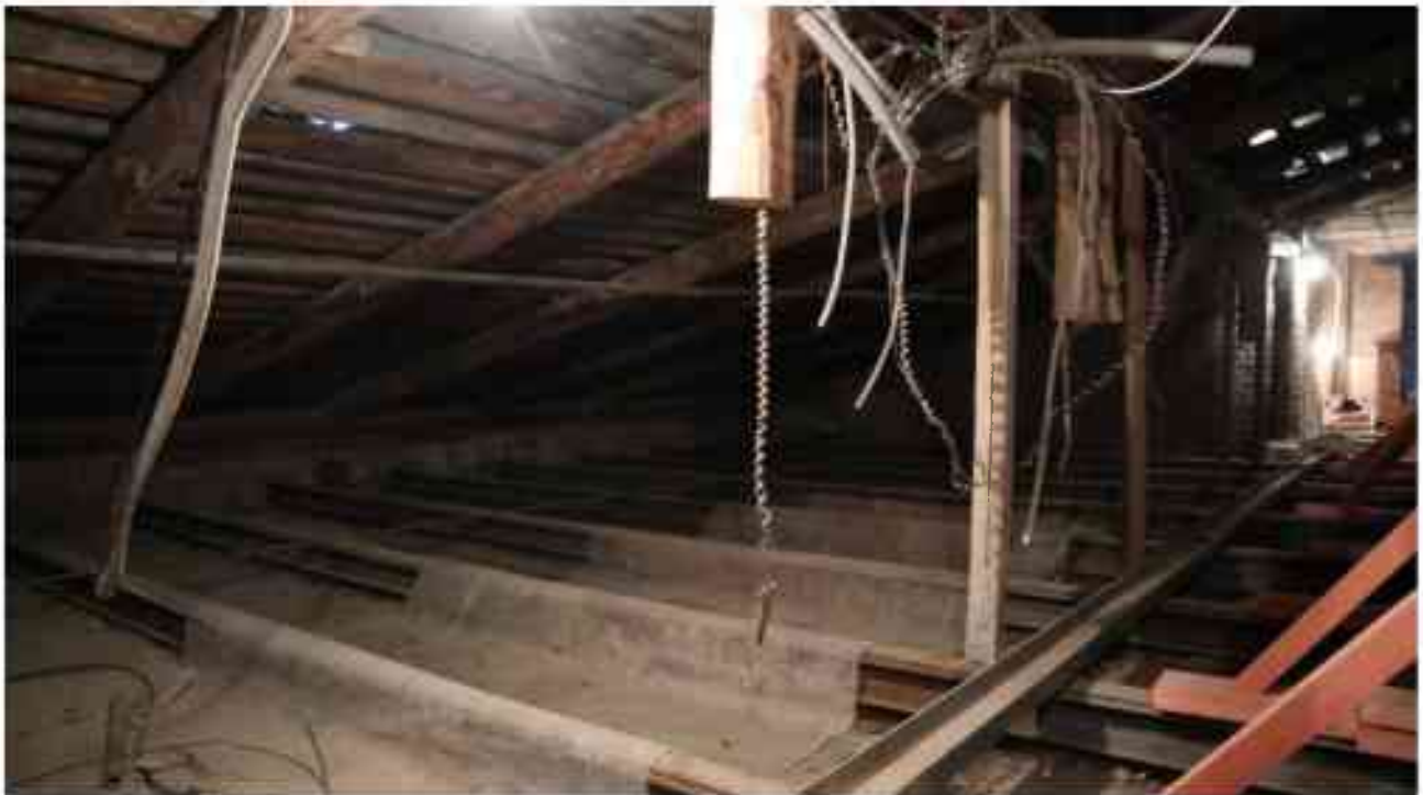
Фото 6.11. 6 этаж, чердачное помещение.
