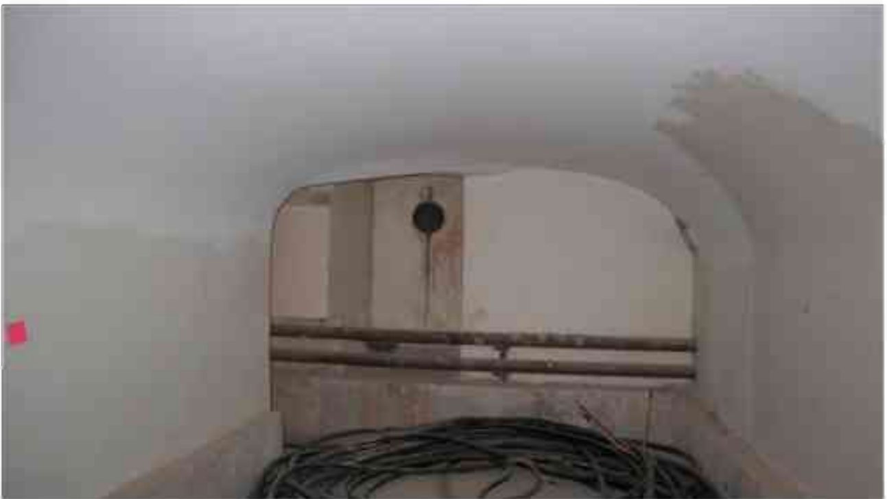
Фото п.95. Подвал, помещение 4Н (1), 8Н (7).
