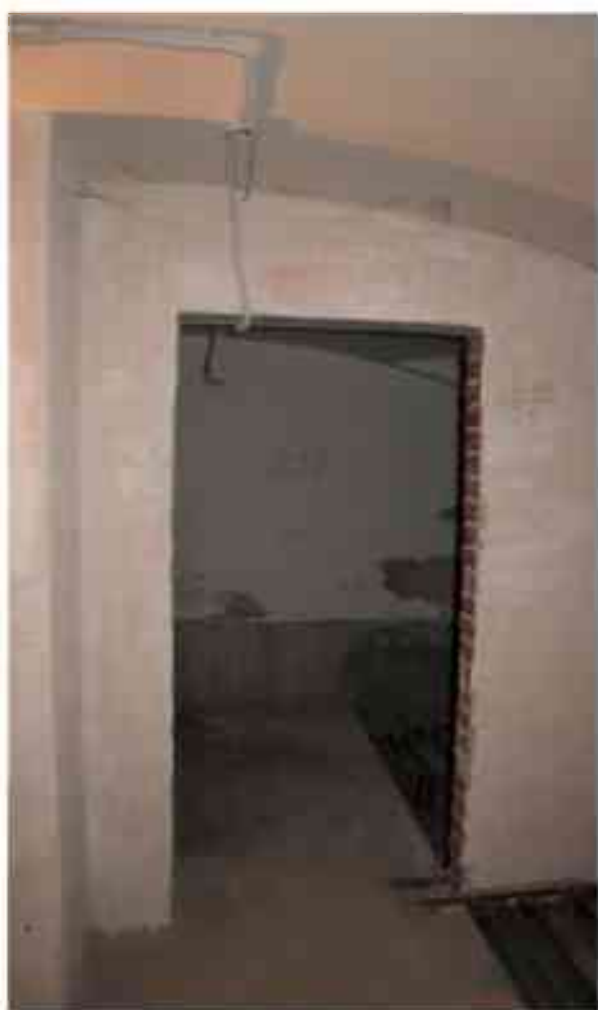
Фото п.213. Подвал, помещение 9Н (4).
