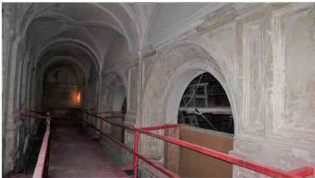
Фото 4.159. 4 этаж, помещение 30Н (4).
