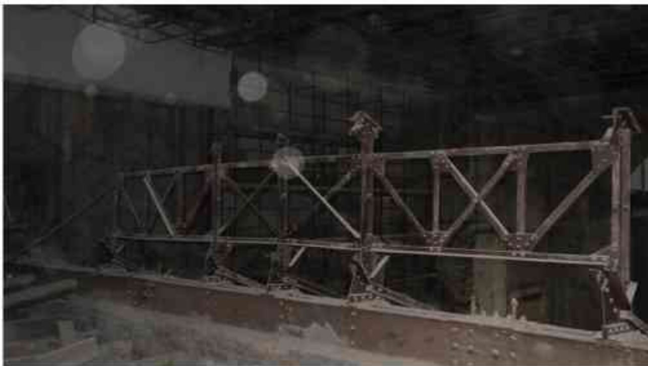
Фото 4.202. 4 этаж, помещение 30Н (3).
