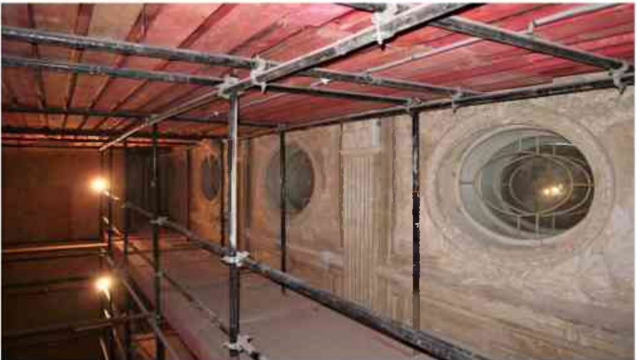
Фото 3.82. 3 этаж, помещение 28Н (2).*
