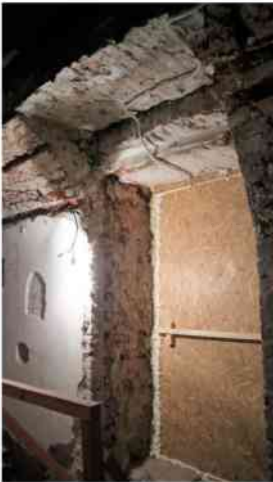
Фото 5.5. 5 этаж, помещение 37Н (1).
