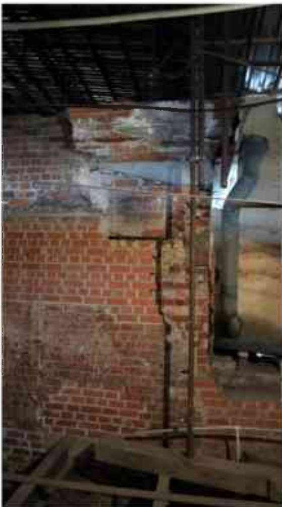
Фото 5.187. 5 этаж, коридор, помещения 34Н/37Н.
