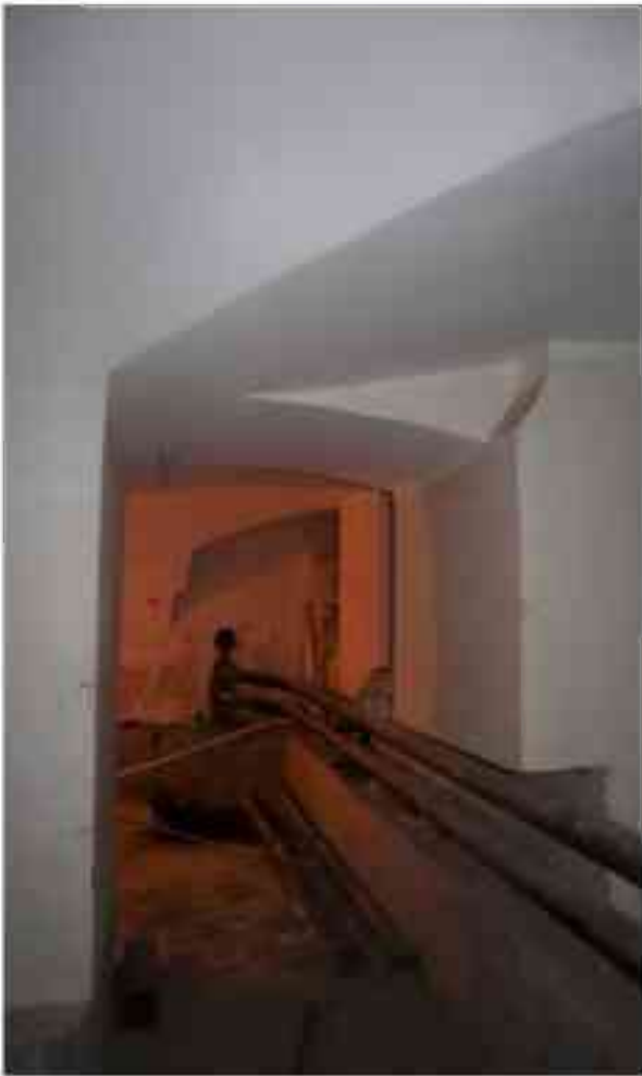
Фото п.96. Подвал, помещение 8Н (7-8).
