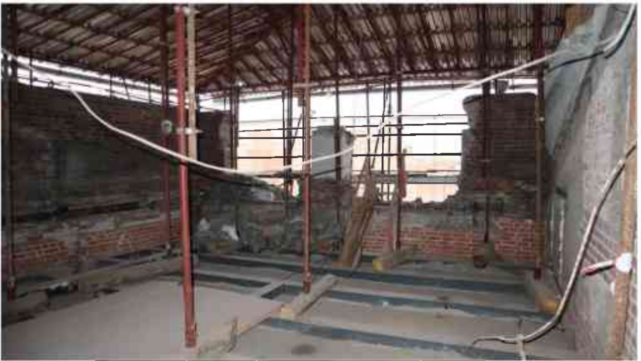
Фото 5.189. 5 этаж, чердачное помещение.
