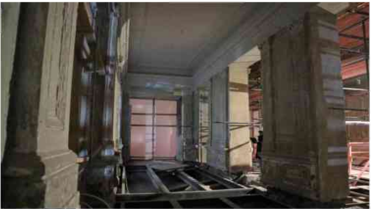
Фото 2.160. 2 этаж, помещение 22Н (20).
