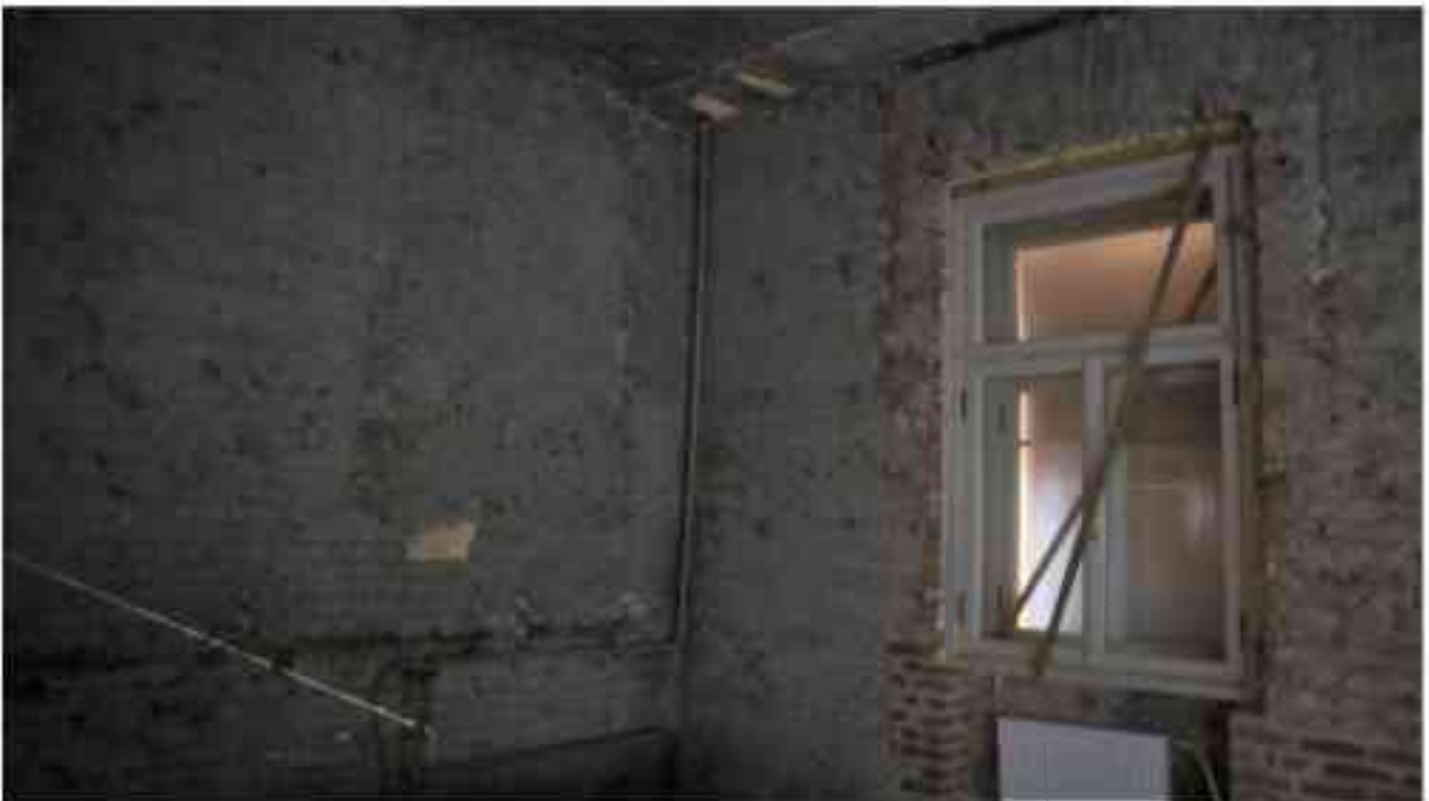
Фото 2.210. 2 этаж, помещение 22Н (2-6, 9).
