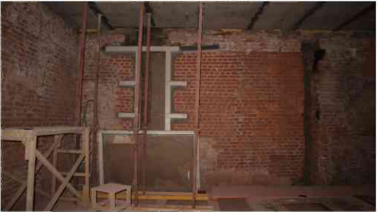
Фото 4.69. 4 этаж, помещение 33Н (51).
