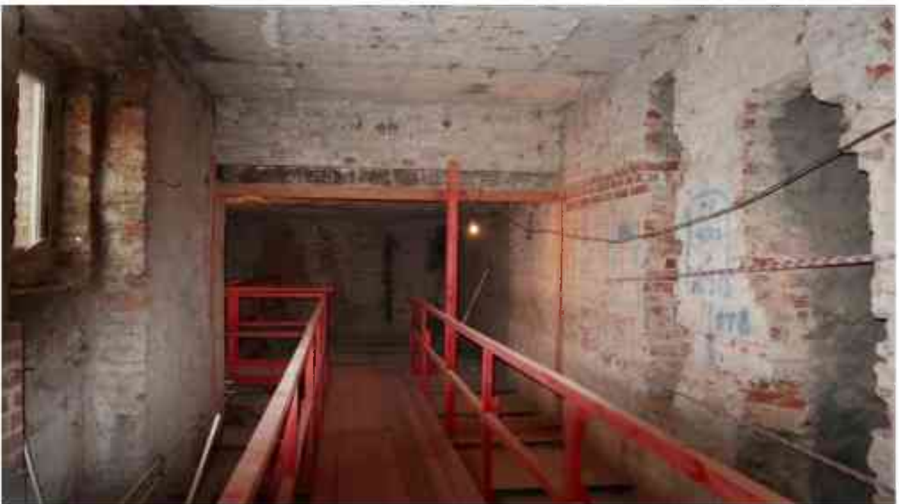
Фото 5.41. 5 этаж, помещение 38Н (1).
