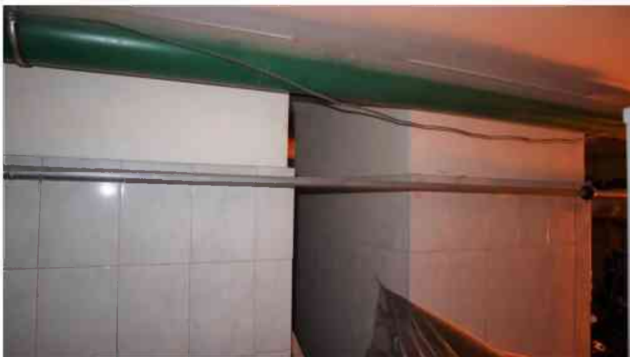
Фото п.307. Подвал, помещение 3Н (16).
