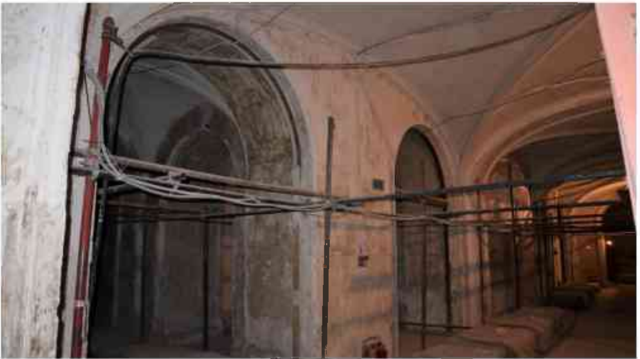
Фото 1.249. 1 этаж, помещение 13Н (10).
