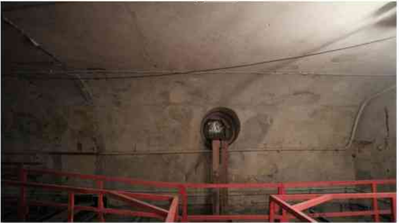
Фото 5.98. 5 этаж, помещение 35Н(2).
