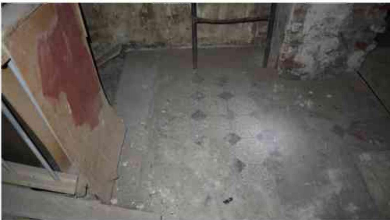
Фото 5.152. 5 этаж, жилой блок, на плане ПИБ 2000г. обозначен как квартиры, помещение (3).
