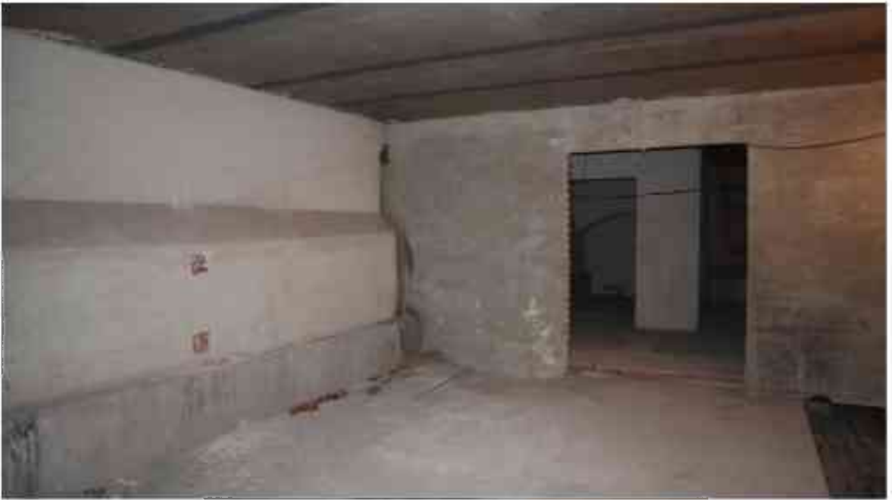
Фото п.231. Подвал, помещение 9Н (23-24).
