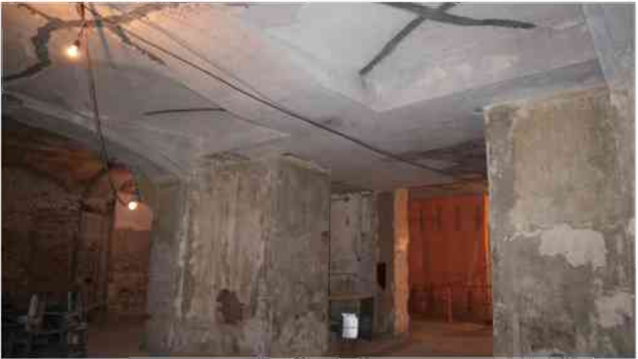
Фото 1.300. 1 этаж, помещение 13Н (4).
