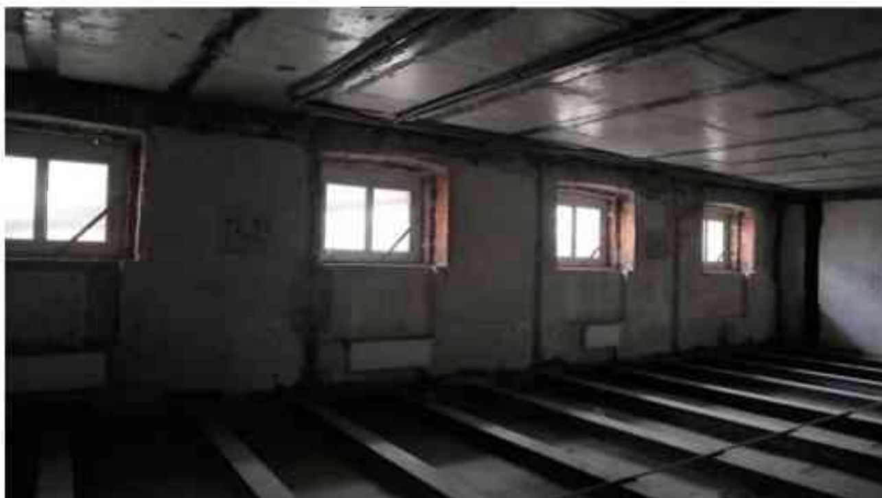
Фото 5.11. 5 этаж, помещение 37Н (2-5).
