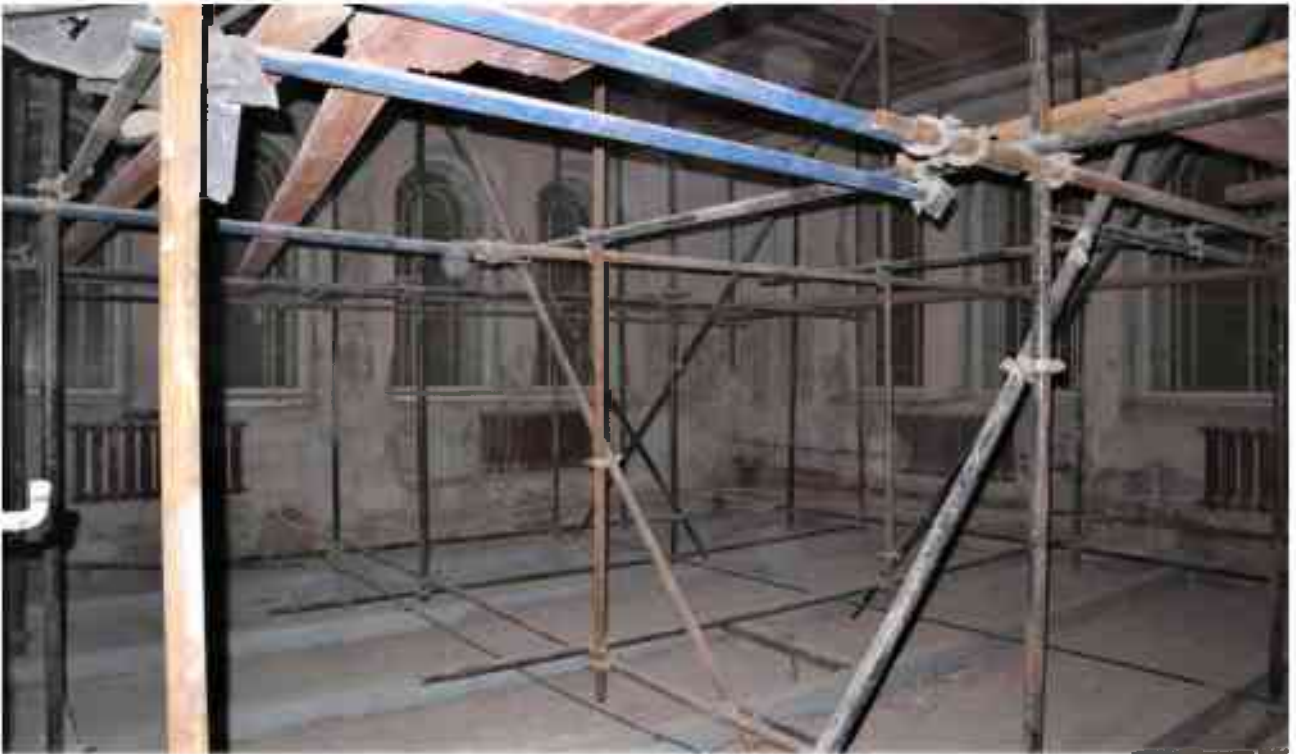
Фото 4.143. 4 этаж, помещение 30Н (12).
