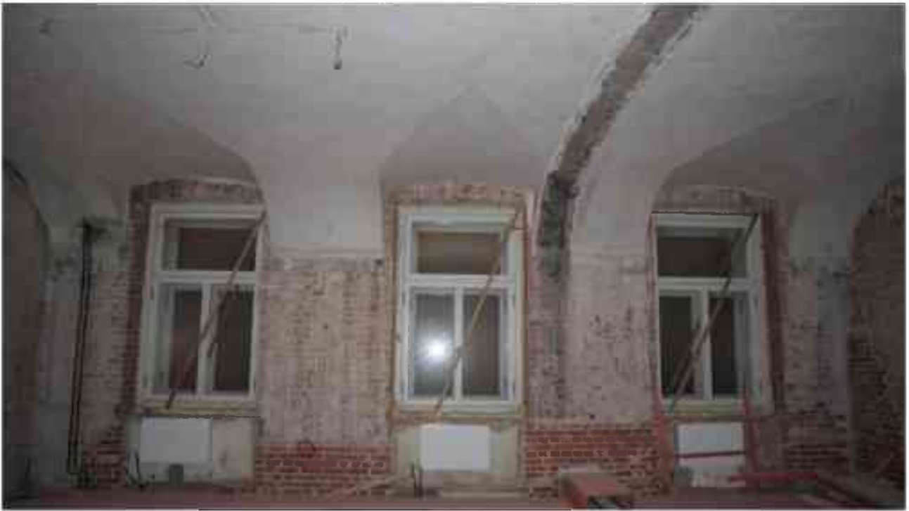
Фото 2.3. 2 этаж, помещение 22Н (42).
