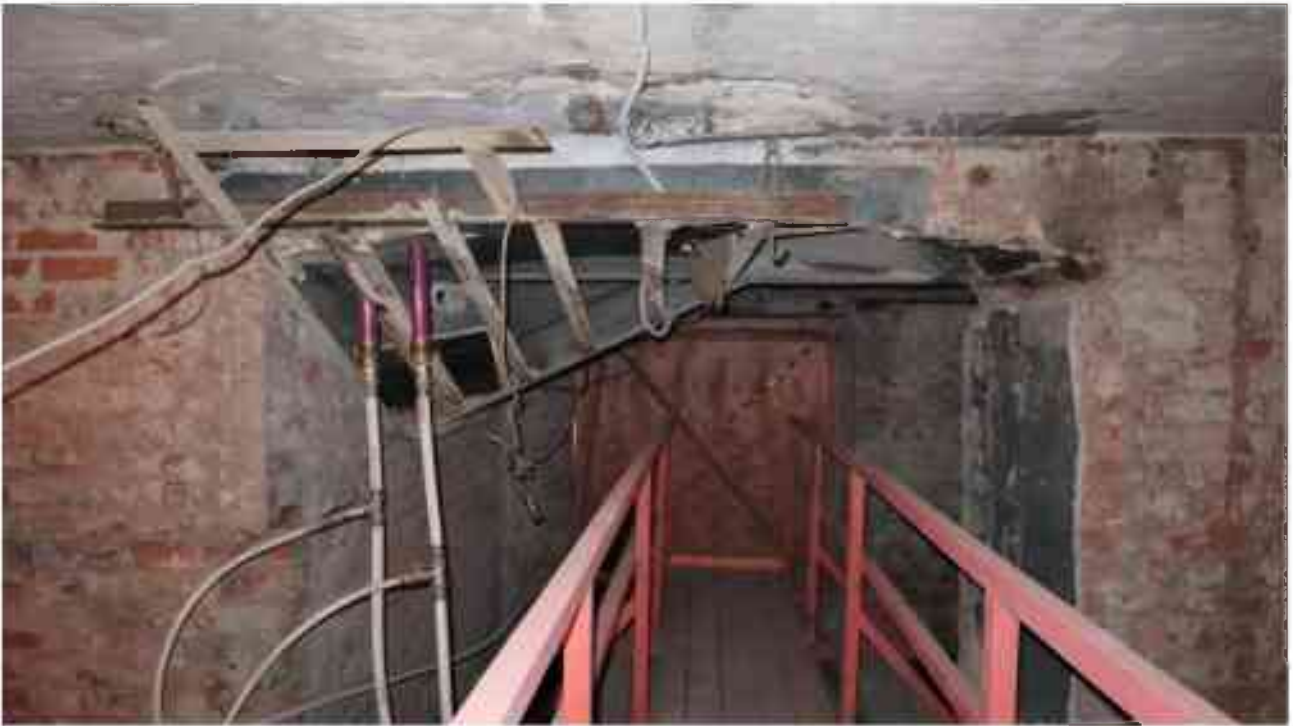
Фото п.340. Подвал, помещение 18Н (5).
