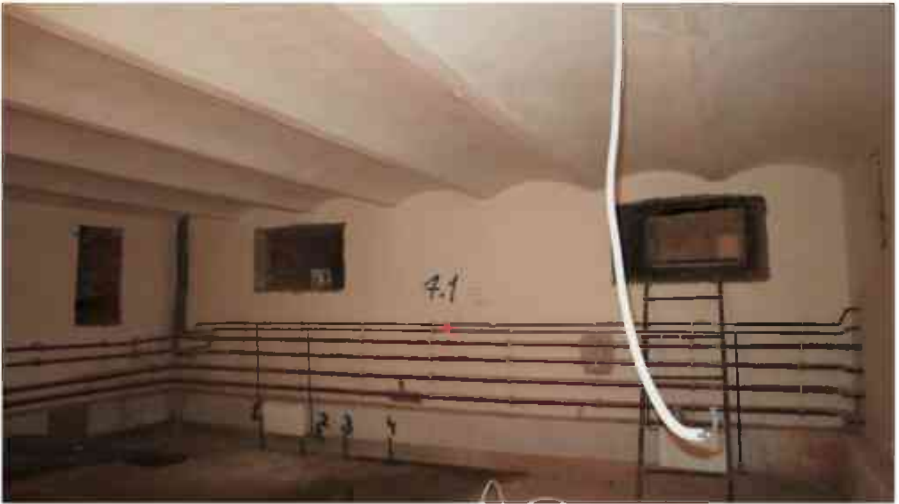
Фото п.260. Подвал, помещение 6Н (7).
