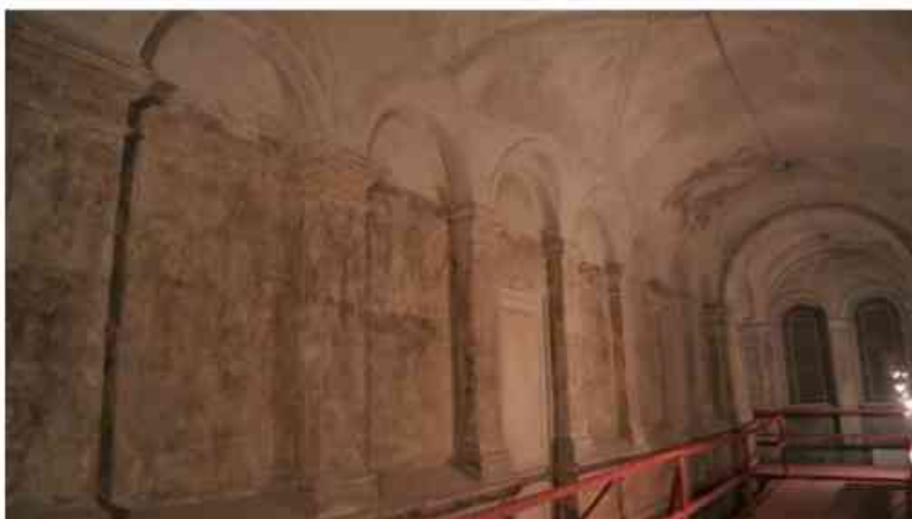
Фото 4.154. 4 этаж, помещение 30Н (4).
