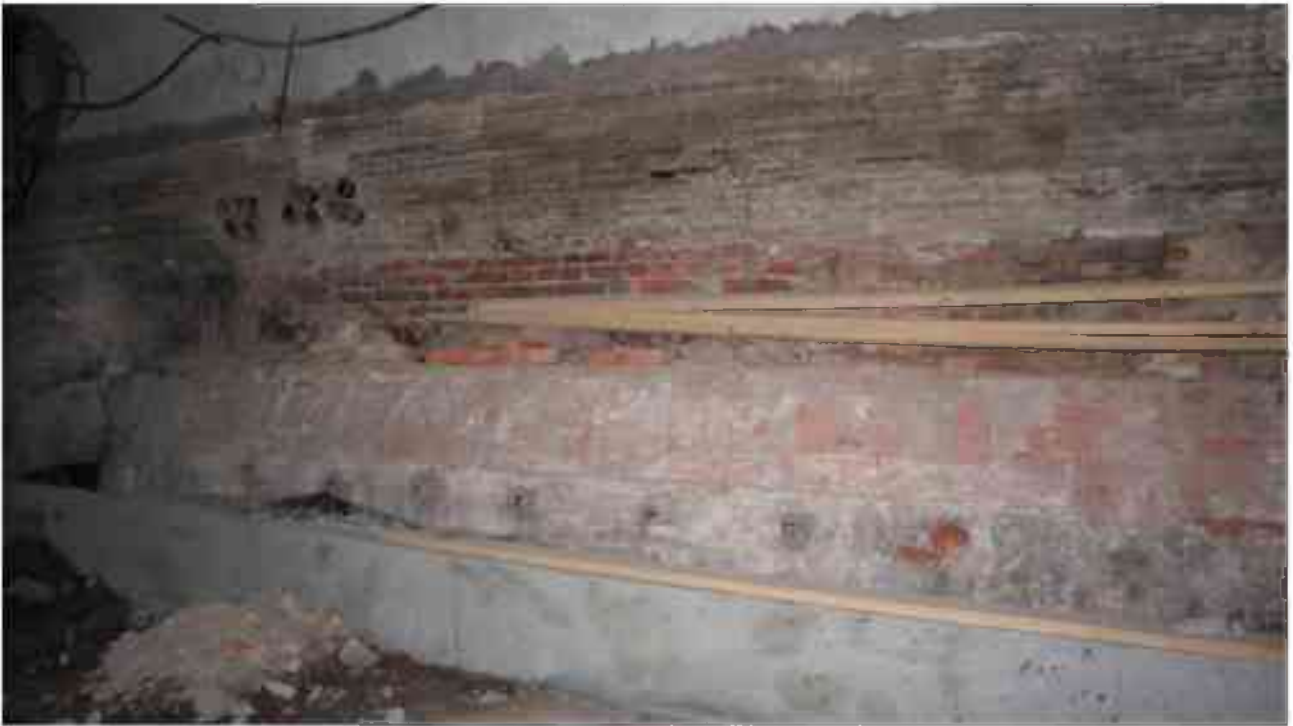
Фото п.314. Подвал, помещение 9Н (1).
