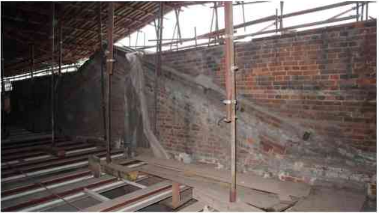
Фото 5.172. 5 этаж, чердачное помещение.
