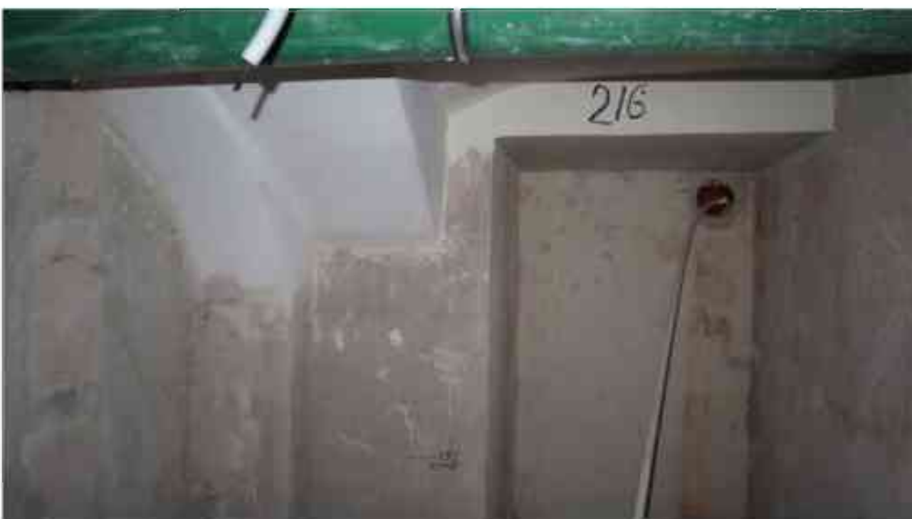
Фото п.83. Подвал, помещение 9Н (21).
