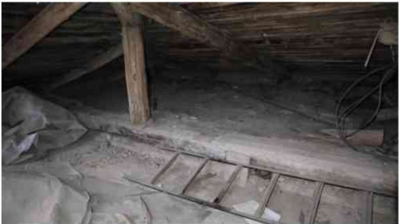
Фото 6.51. 6 этаж, чердачное помещение.
