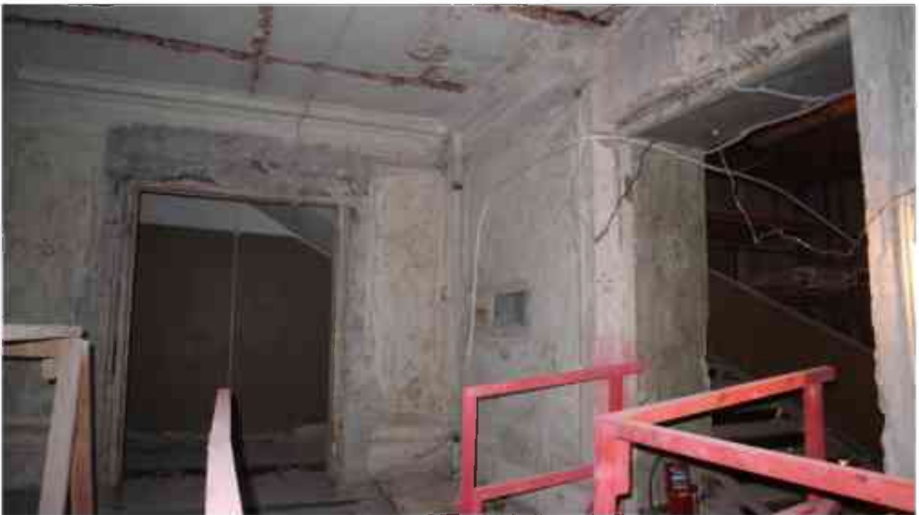
Фото 3.137. 3 этаж, помещение 25Н (1).
