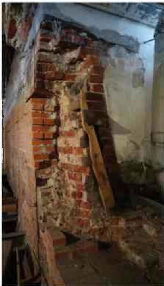
Фото 5.182. 5 этаж, коридор, помещения 34Н/37Н.
