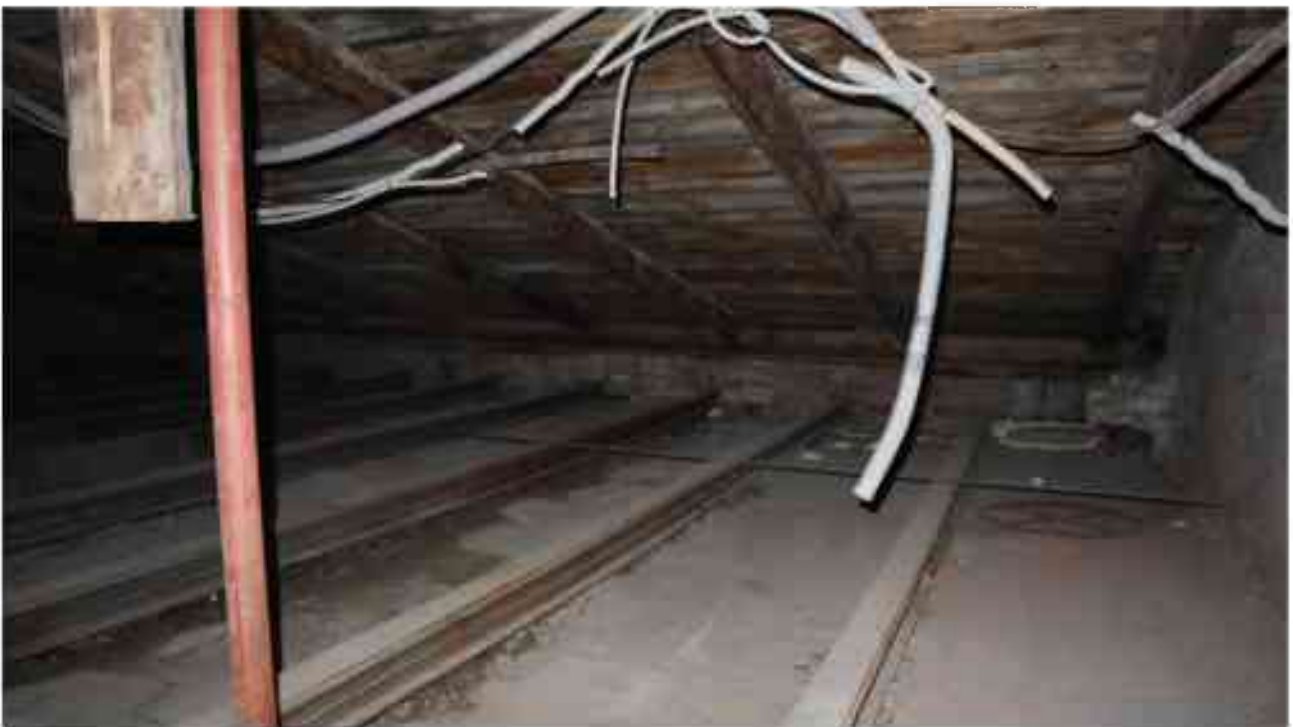
Фото 6.9. 6 этаж, чердачное помещение.
