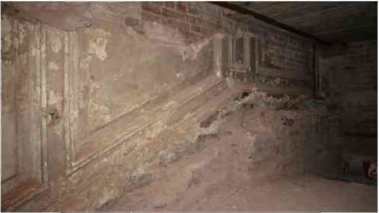
Фото 1.347. 1 этаж, помещение в центре здания, западнее лестницы с перекрестными маршами.*
