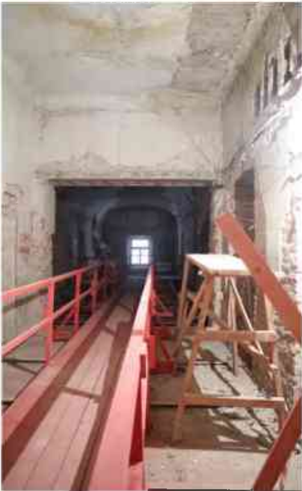
Фото 3.161. 3 этаж, помещение 23Н (8-9).
