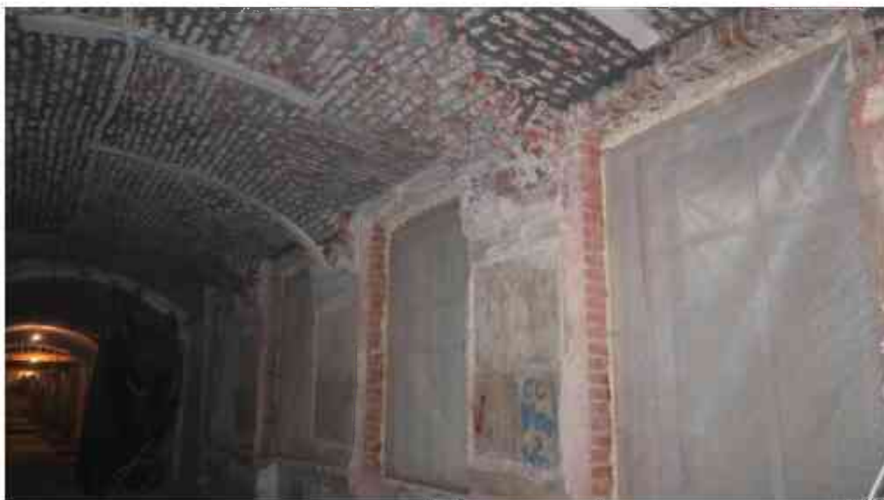
Фото 4.32. 4 этаж, помещение 33Н (30).
