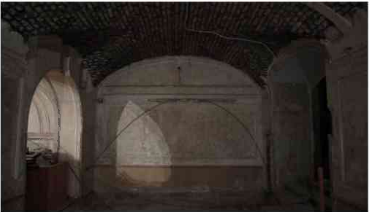
Фото 4.3. 4 этаж, помещение 33Н (30).
