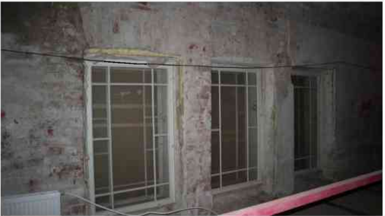
Фото 4.133. 4 этаж, помещение 30Н (1).
