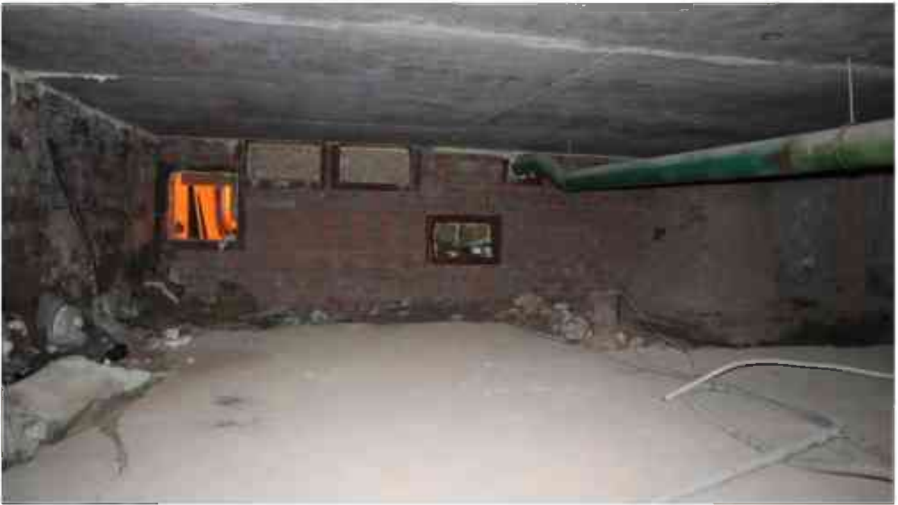
Фото п.303. Подвал, помещение 3Н (16).
