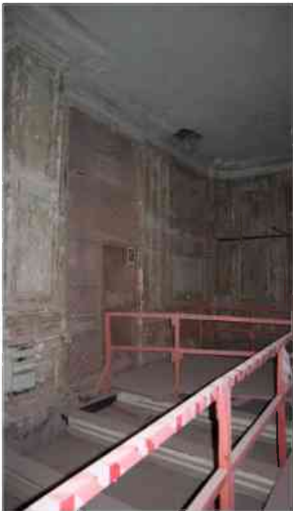
Фото 2.81. 2 этаж, помещение 22Н (28).
