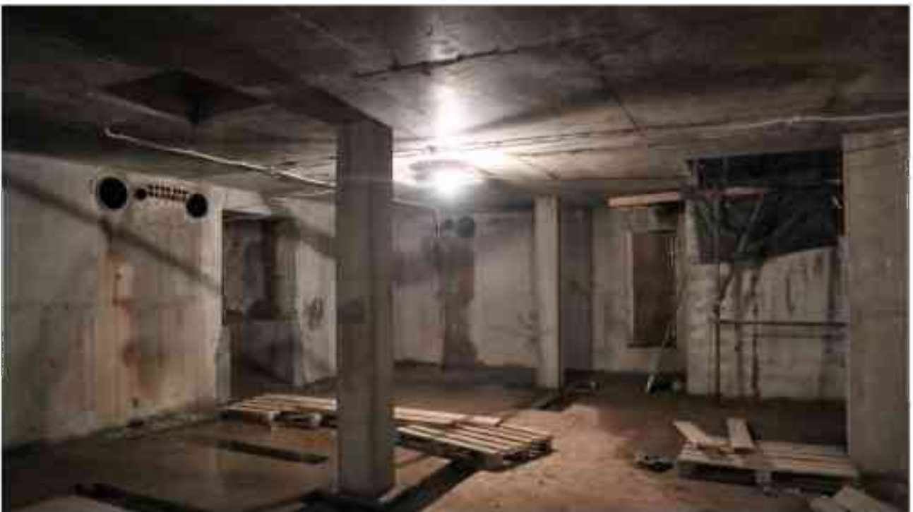
Фото п.243. Подвал, восточного двора.*
