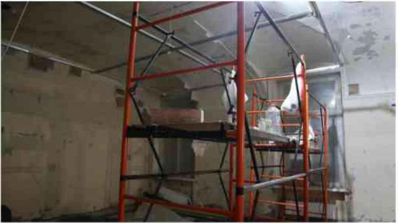
Фото 3.40. 3 этаж, помещение 28Н (18).
