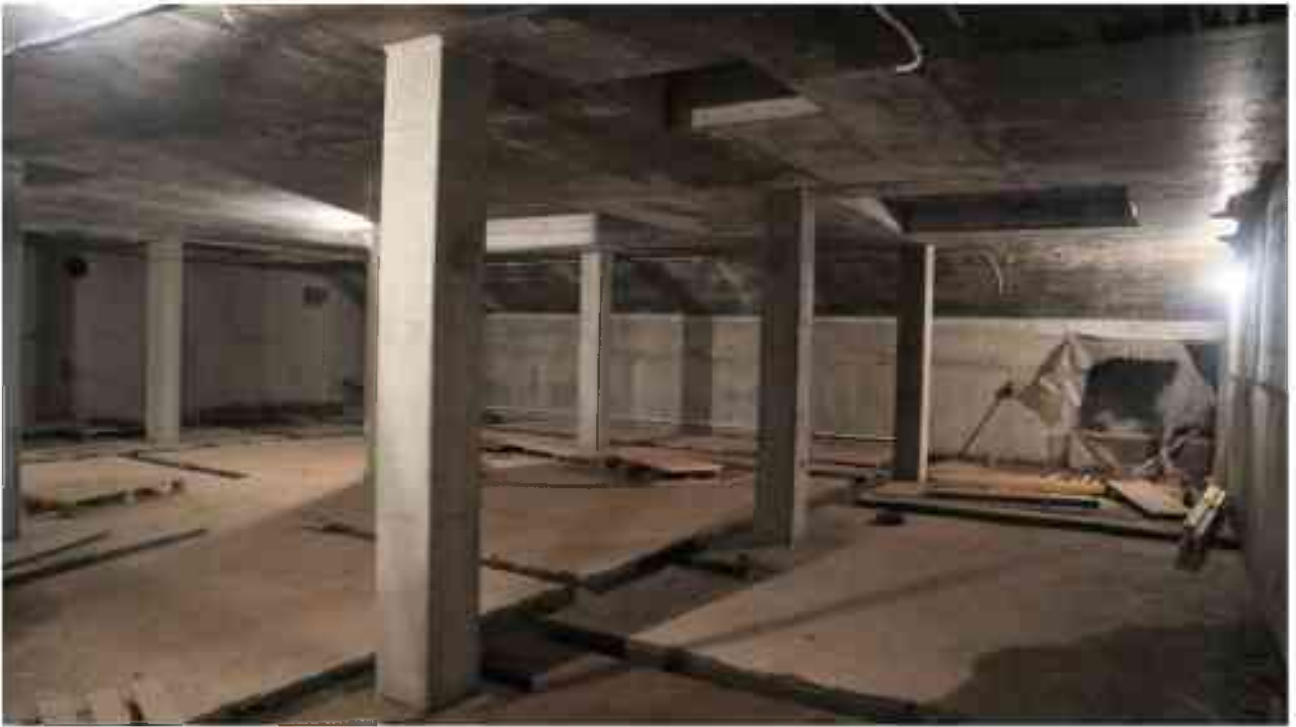
Фото п.238. Подвал, восточного двора.*
