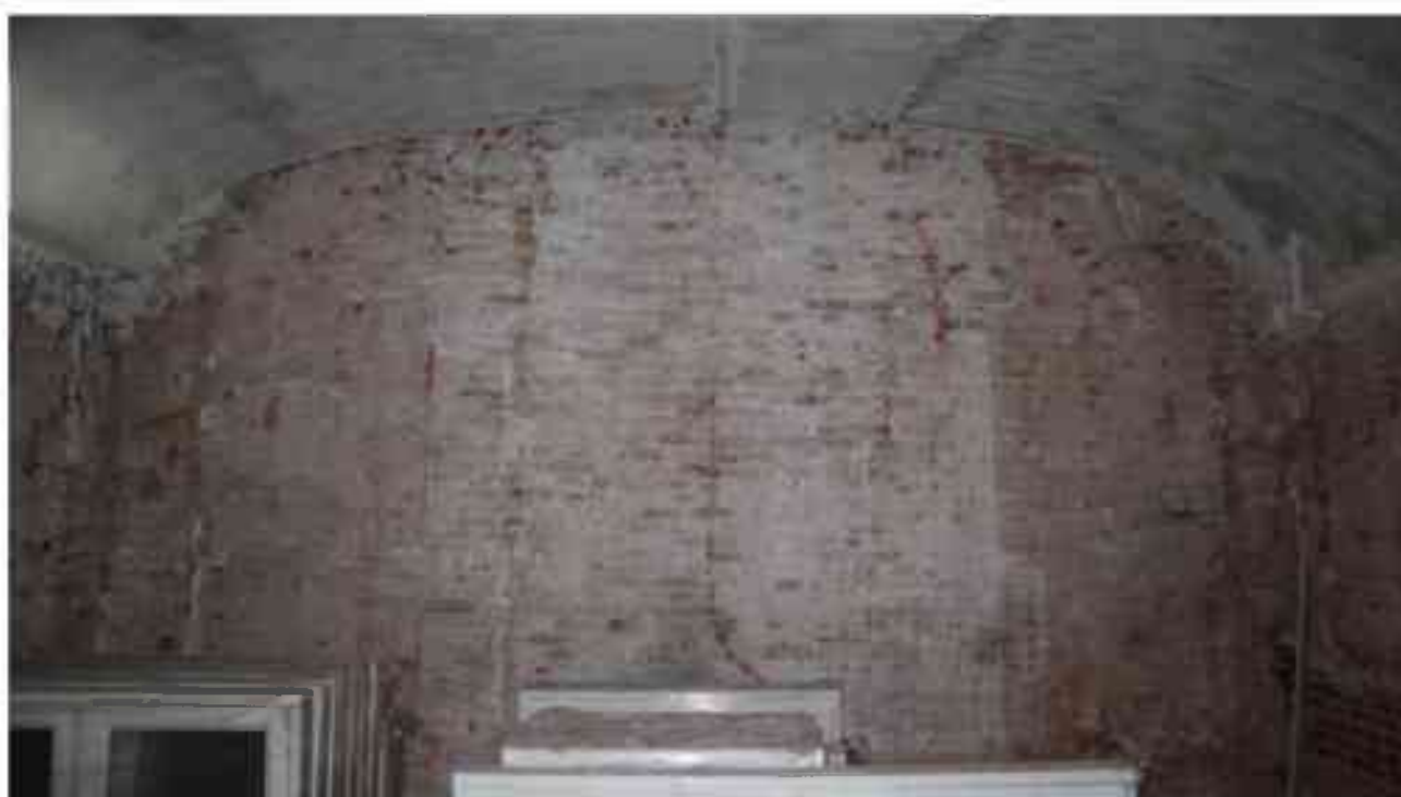
Фото 2.107. 2 этаж, помещение 22Н (44).
