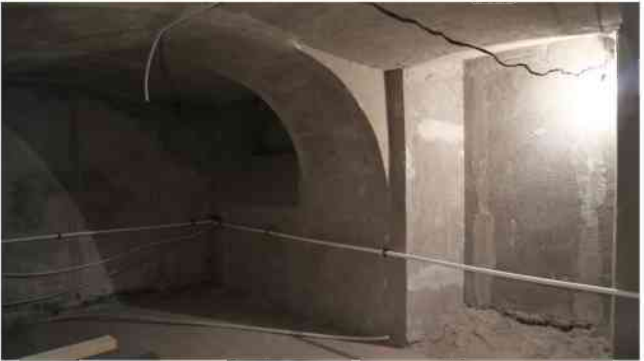
Фото п.5. Подвал, помещение 1Н (1-3).
