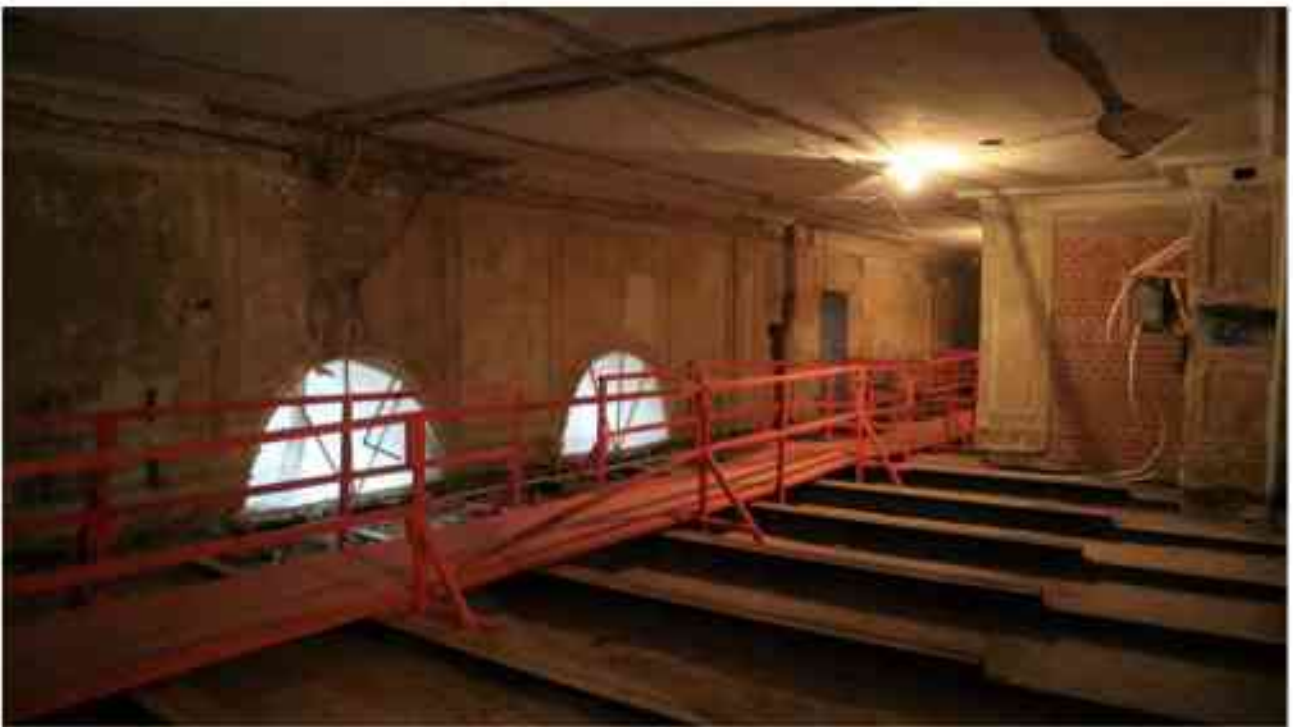
Фото 3.121. 3 этаж, помещение 25Н (5).
