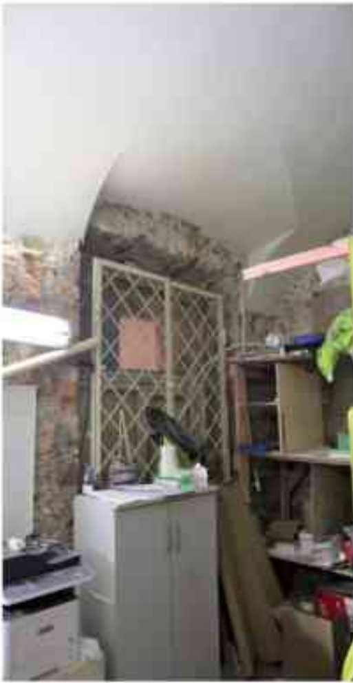
Фото 1.36. 1 этаж, помещение 14Н (8-9).
