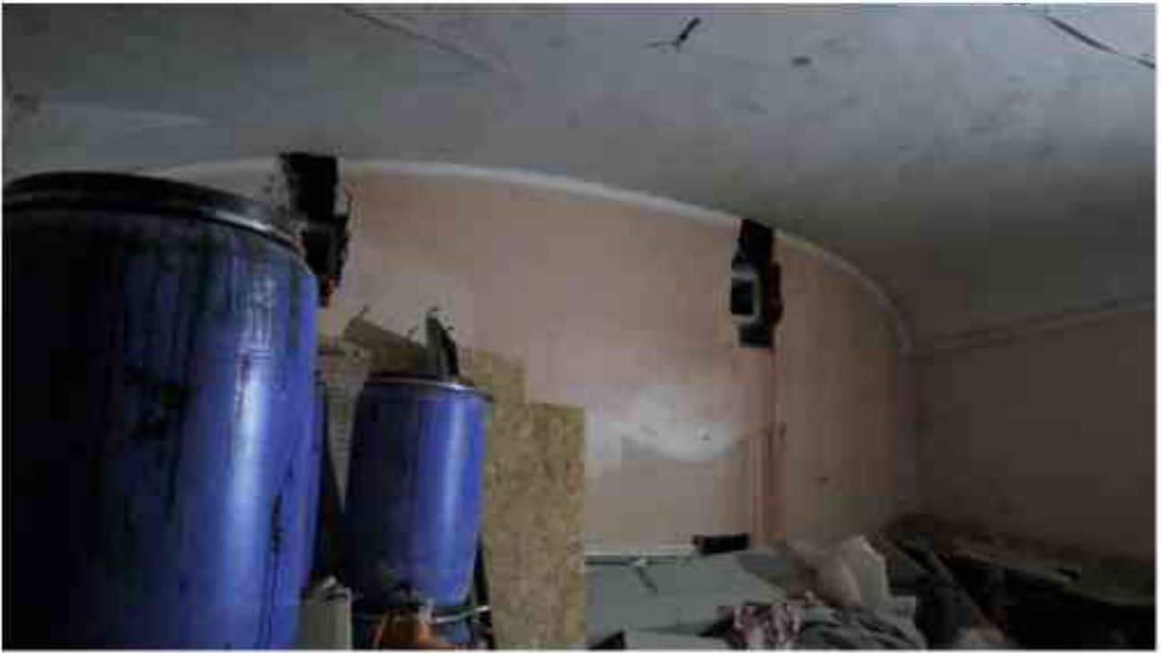
Фото 2.55. 2 этаж, помещение 22Н (50).
