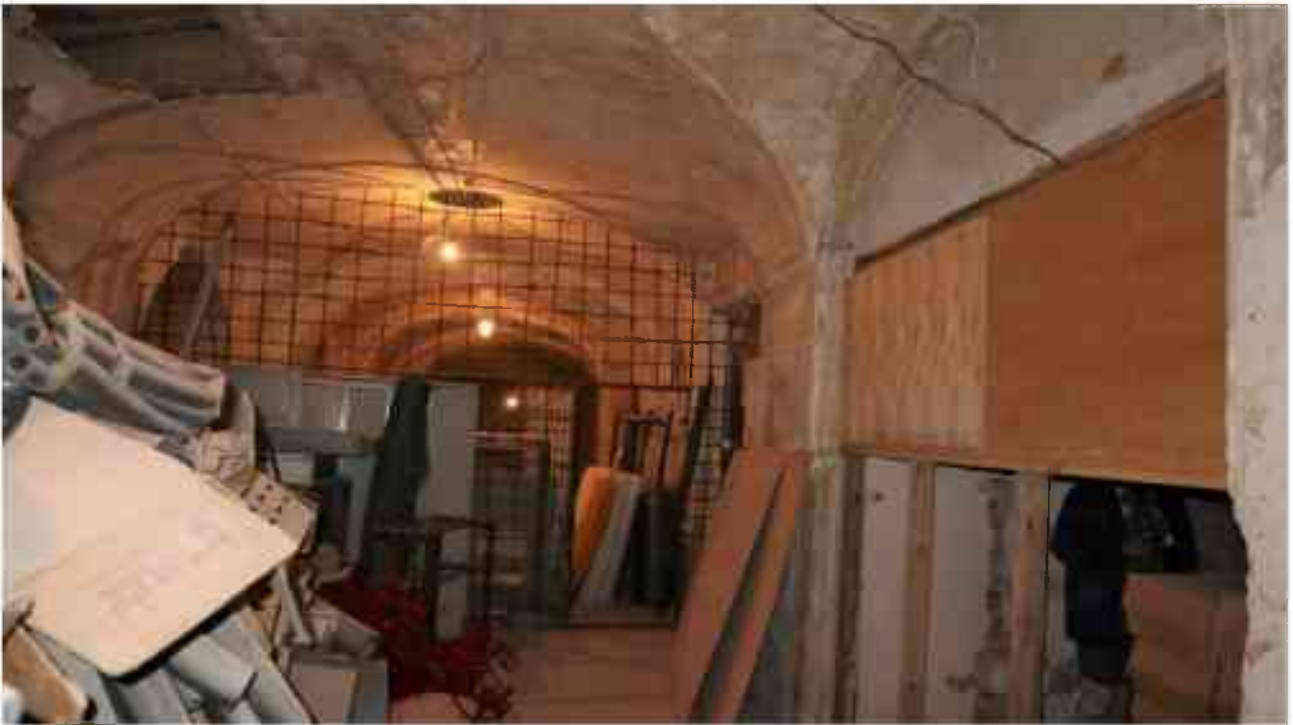
Фото 1.145. 1 этаж, помещение 31Н (11, 13-14).
