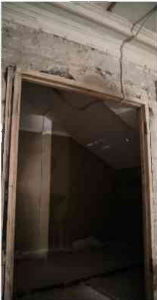
Фото 3.139. 3 этаж, помещение 25Н (10).
