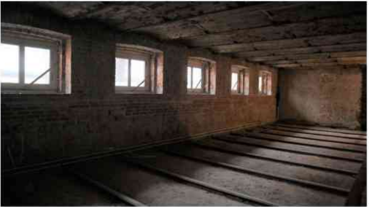
Фото 5.30. 5 этаж, помещение 35Н (21, 23-27).
