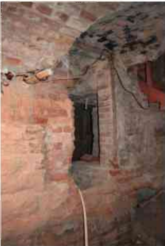
Фото п.291. Подвал, помещение 3Н (17).
