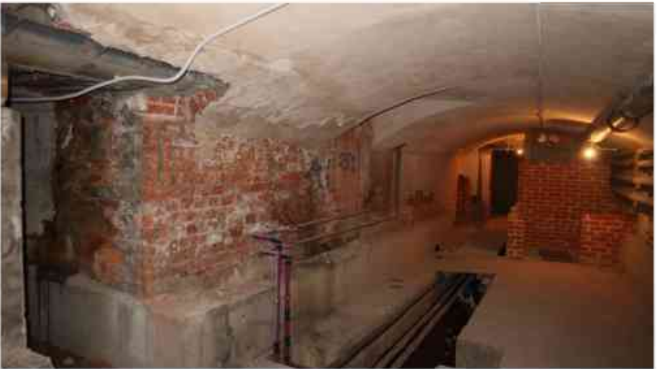
Фото п.194. Подвал, помещение 9Н (21).
