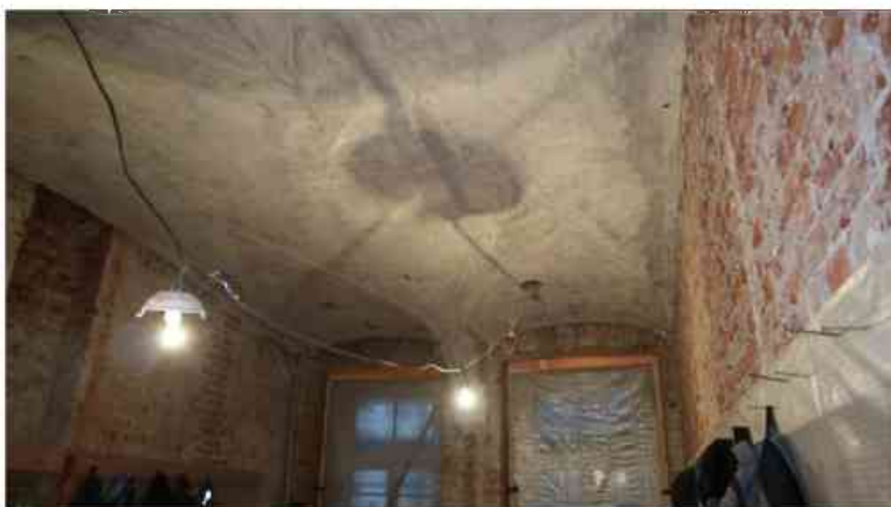
Фото 2.50. 2 этаж, помещение 22Н (61).
