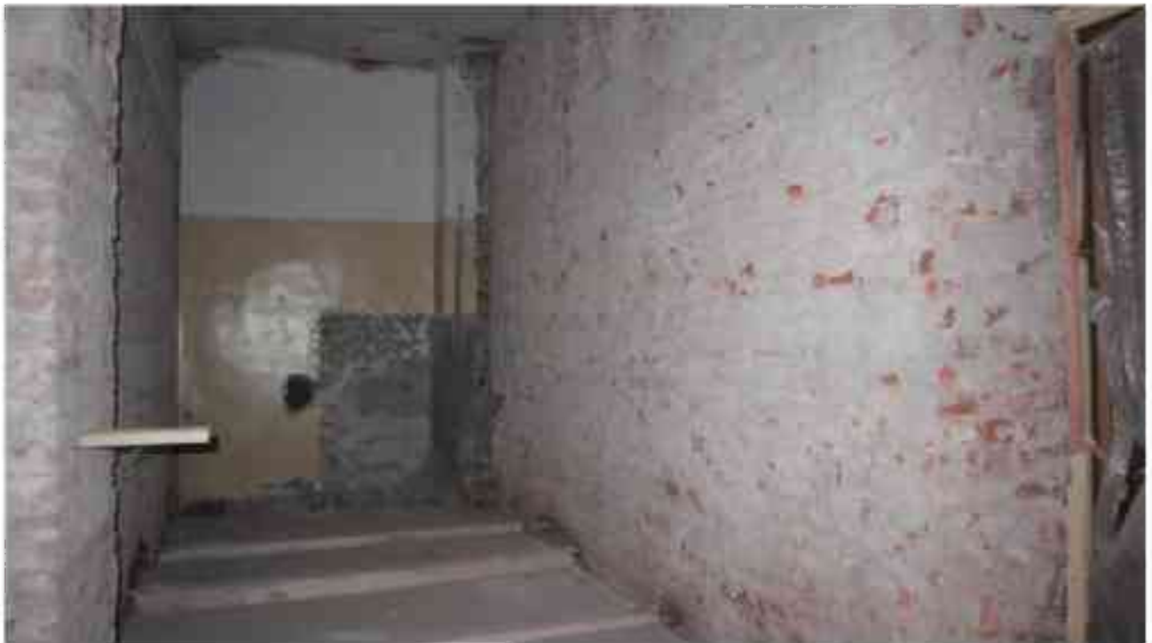
Фото 3.98. 3 этаж, помещение 27Н (1).
