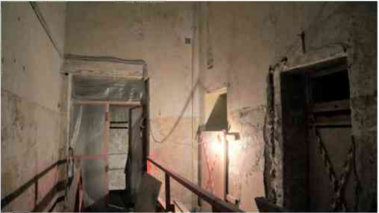
Фото 2.191. 2 этаж, помещение 22Н (7).
