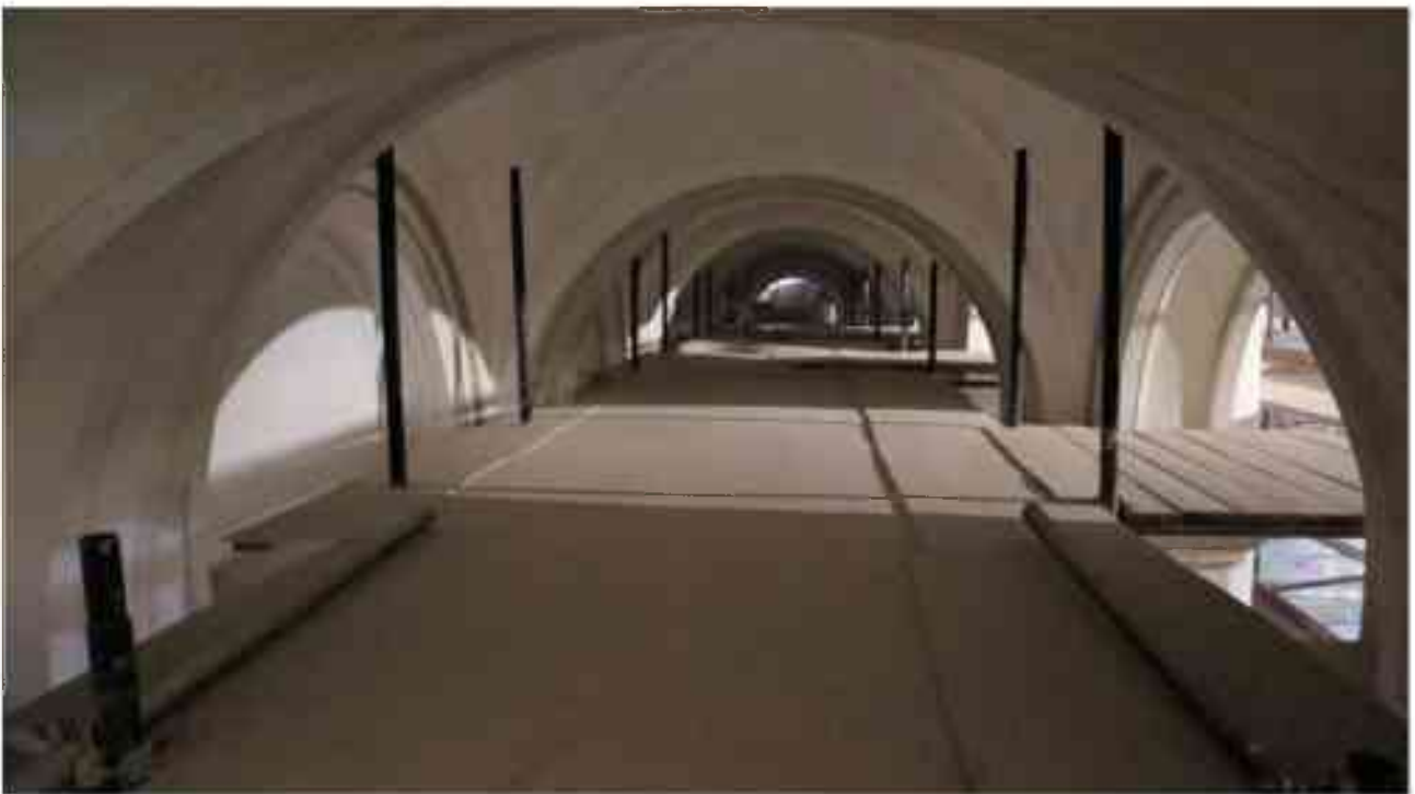
Фото 2.150. 2 этаж, помещение 22Н (19).*
