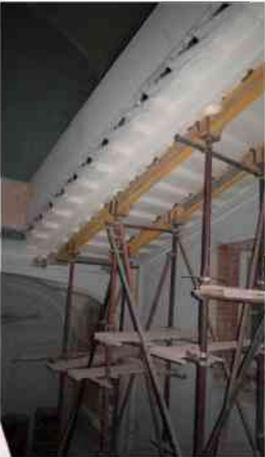
Фото 3.37. 3 этаж, лестница Л-16.
