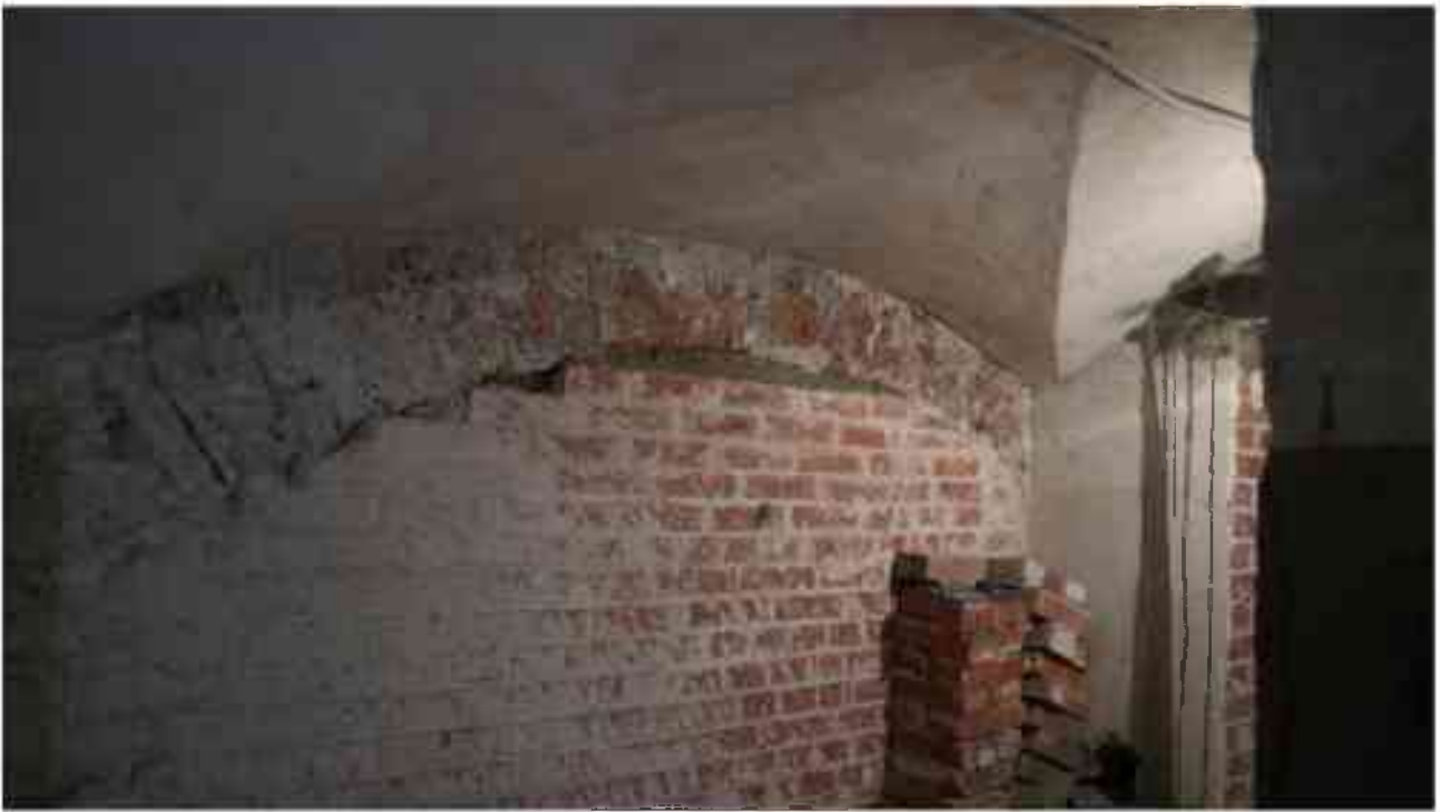
Фото п.195. Подвал, помещение 9Н (21).
