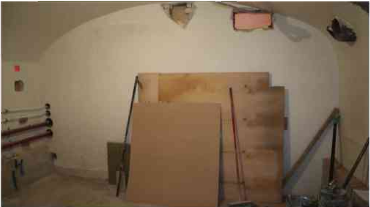
Фото п.163. Подвал, восточная часть помещения 9Н (13), разделенного перегородкой.
