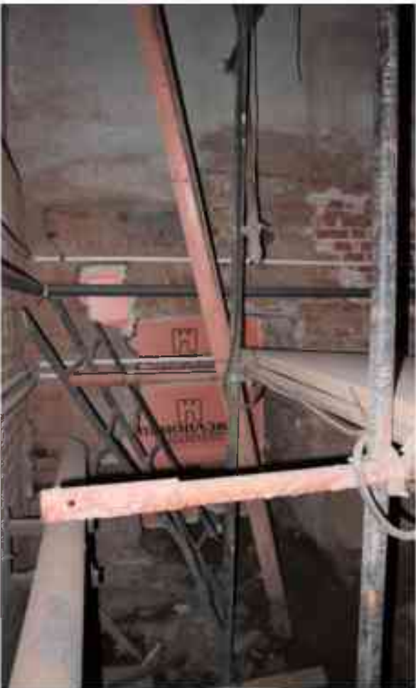
Фото п.76. Подвал, помещение 3Н (2).
