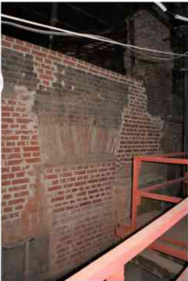
Фото 5.131. 5 этаж, коридор, помещения 34Н/37Н.
