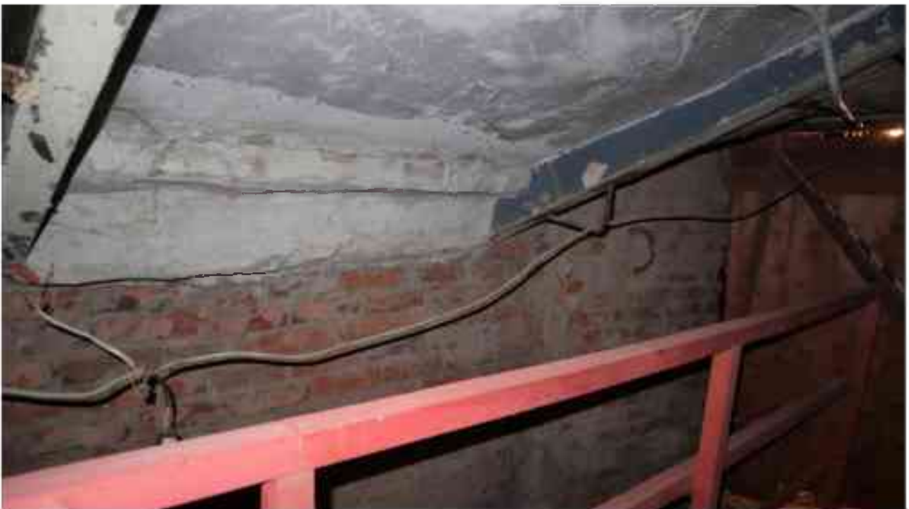
Фото п.341. Подвал, помещение 18Н (5).
