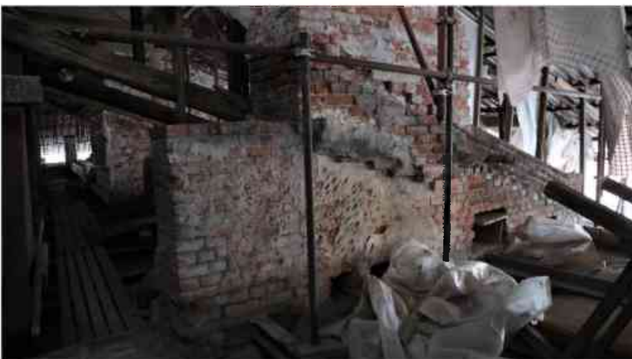
Фото 6.47. 6 этаж, чердачное помещение.
