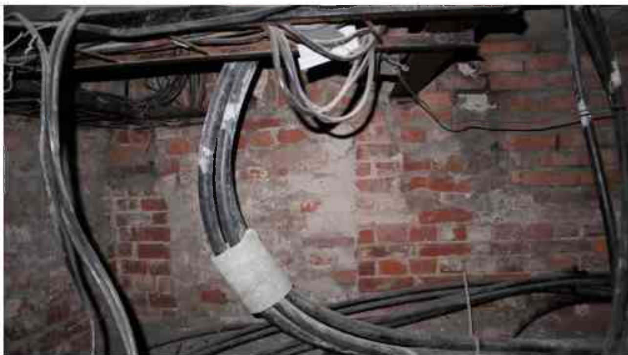
Фото п.348. Подвал, помещение 2Н (6).
