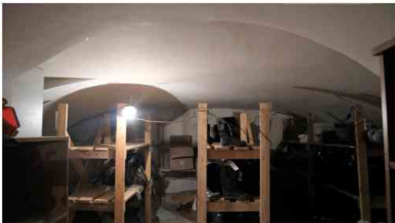
Фото п.122. Подвал, помещение 4Н (3-5).
