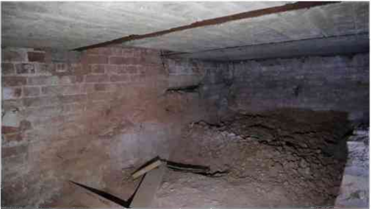
Фото 1.351. 1 этаж, помещение в центре здания, западнее лестницы с перекрестными маршами.*
