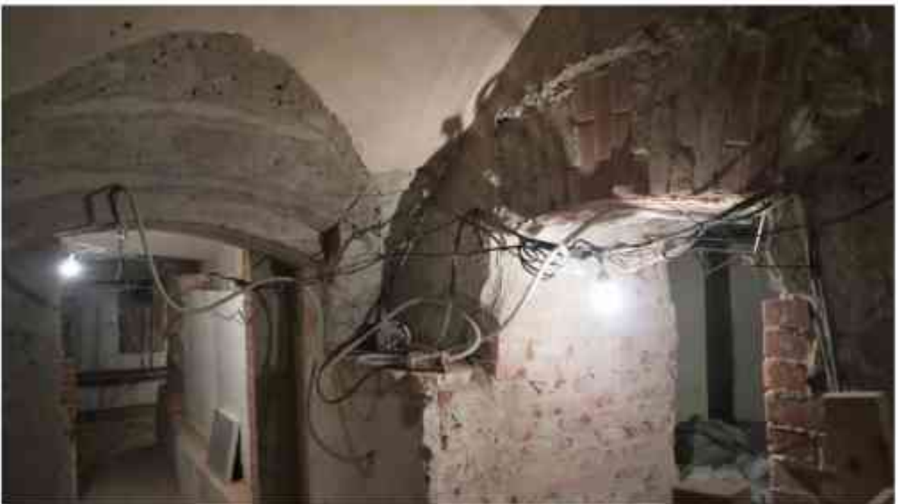
Фото п.246. Подвал, помещение 6Н (10, 12).
