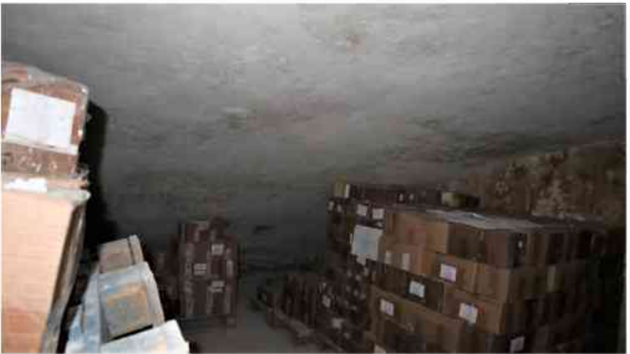
Фото 1.263. 1 этаж, помещение 13Н (26).
