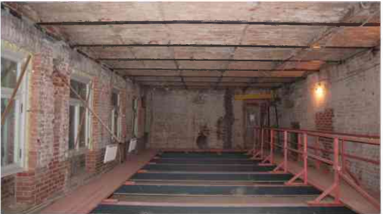
Фото 4.100. 4 этаж, помещение 36Н (1-3, 7-9).
