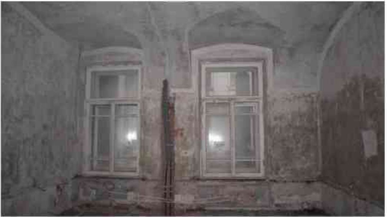
Фото 3.31. 3 этаж, помещение 28Н (28).
