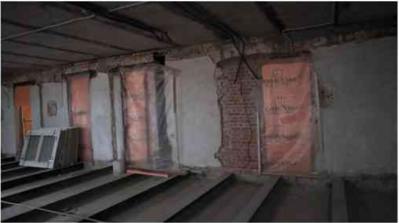
Фото 5.12. 5 этаж, помещение 37Н (2-5).
