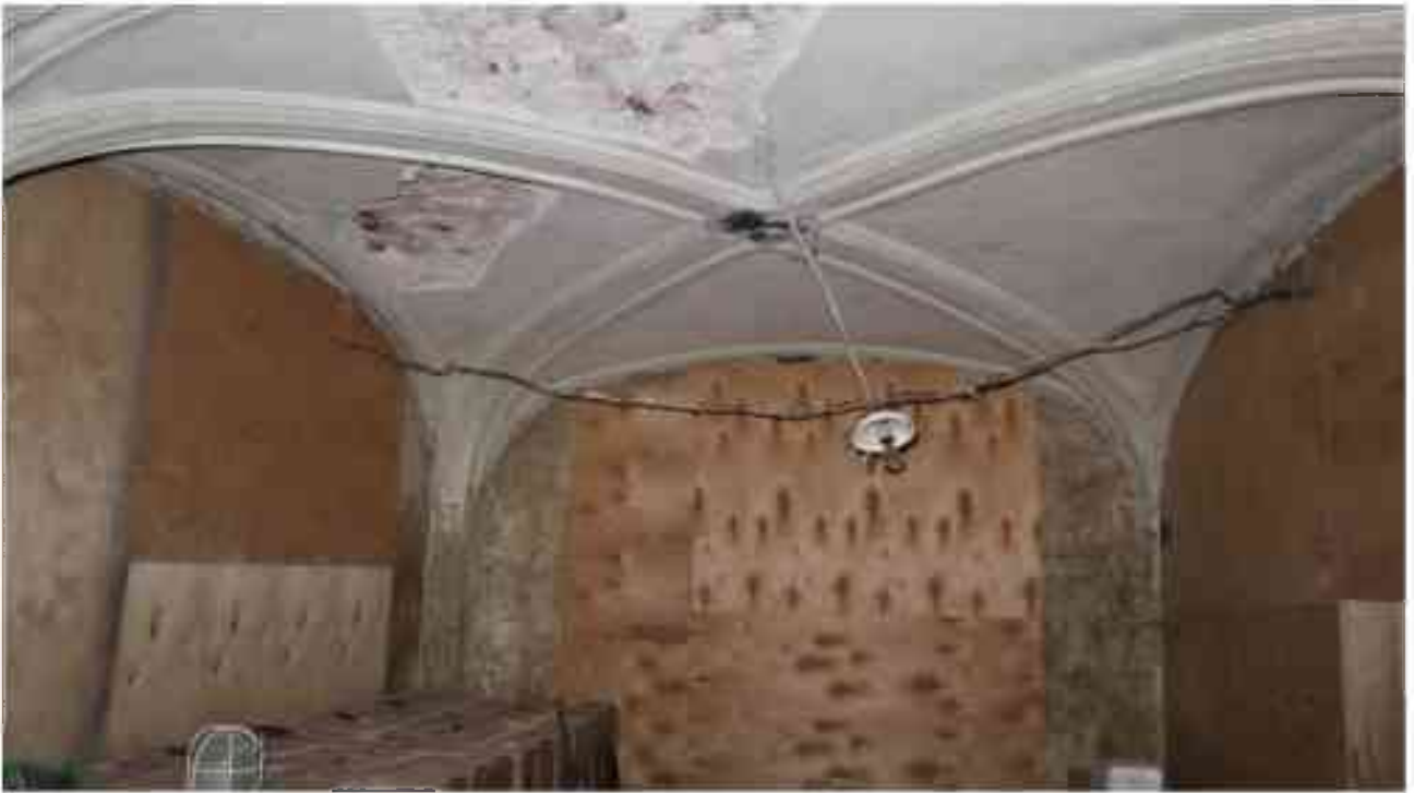
Фото 1.262. 1 этаж, помещение 13Н (24).
