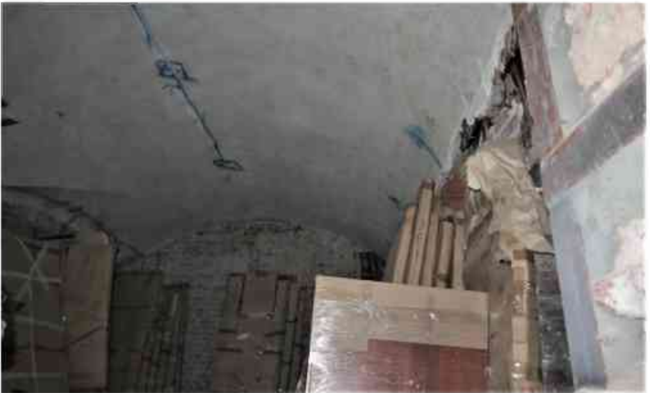
Фото 1.29. 1 этаж, помещение 14Н (16).
