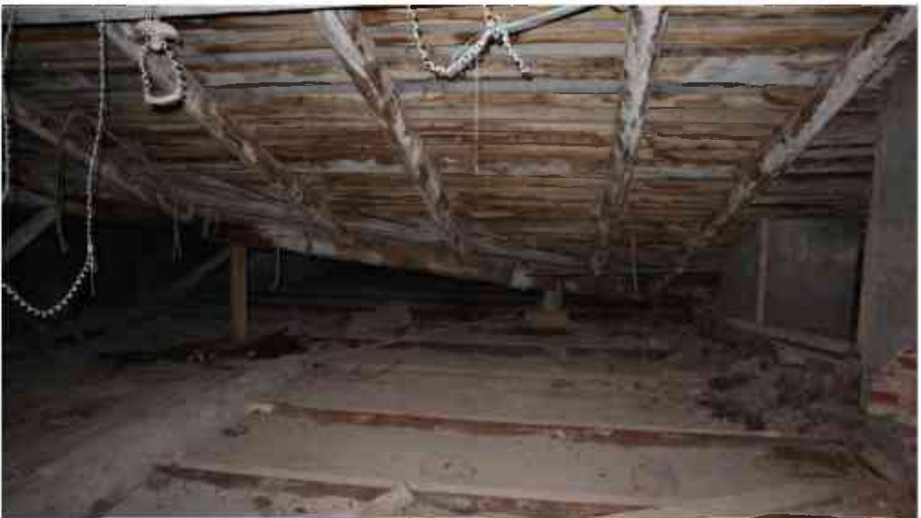
Фото 6.59. 6 этаж, чердачное помещение.
