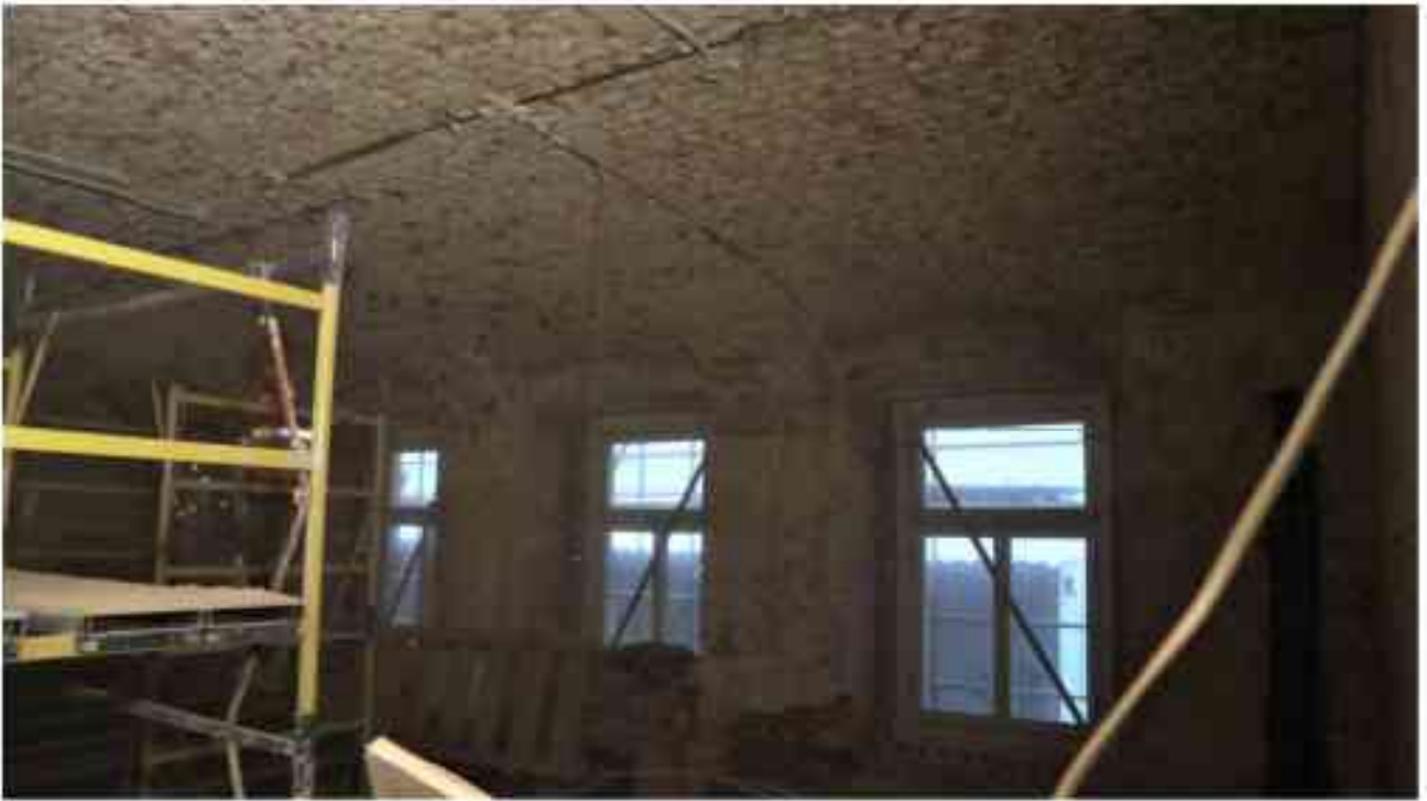
Фото 1.195. 1 этаж, помещение 11Н (1-3, 5).
