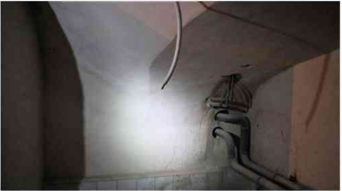
Фото п.252. Подвал, помещение 6Н (2).
