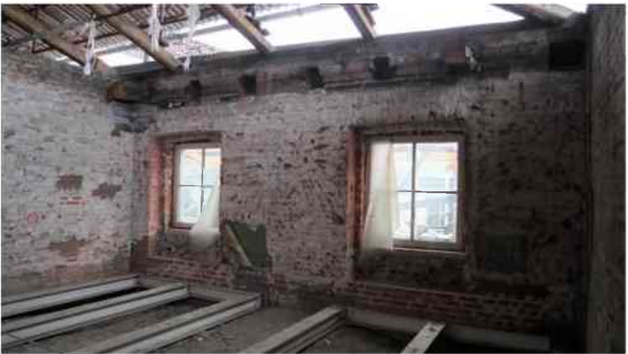
Фото 5.137. 5 этаж, жилой блок, на плане ПИБ 2000г. обозначен как квартиры, помещение (7-8).
