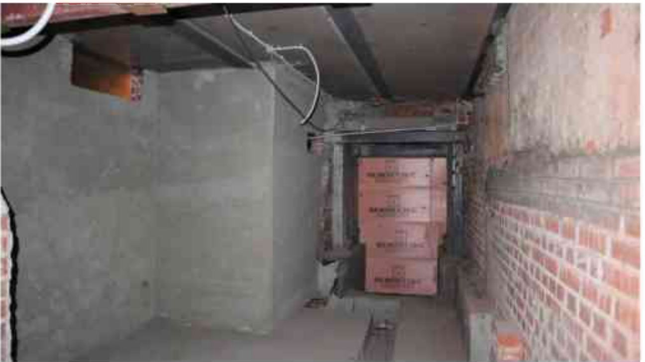
Фото п.228. Подвал, помещение 9Н (23, 24).
