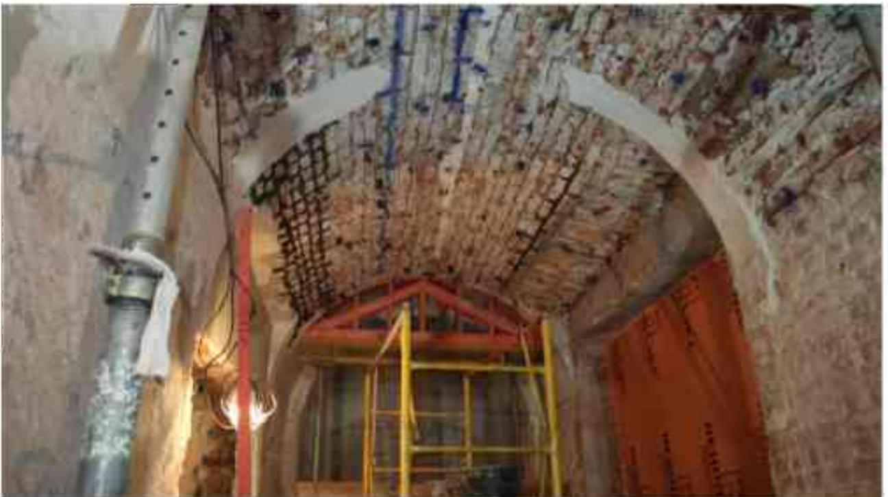
Фото 2.52. 2 этаж, помещение 22Н (60).
