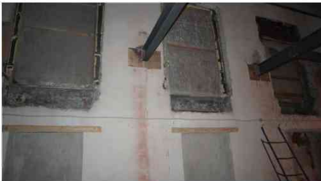
Фото п.332. Подвал, помещение 1Н (4-8).
