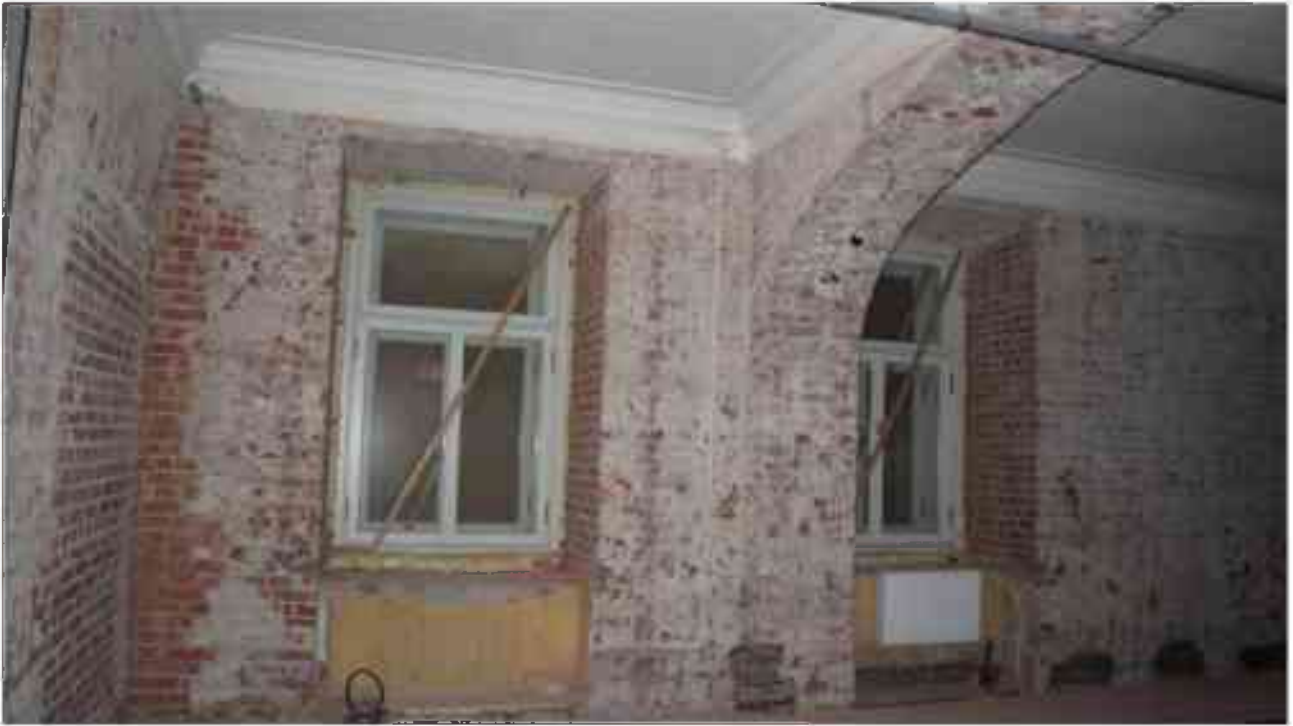
Фото 2.21. 2 этаж, помещение 22Н (48).
