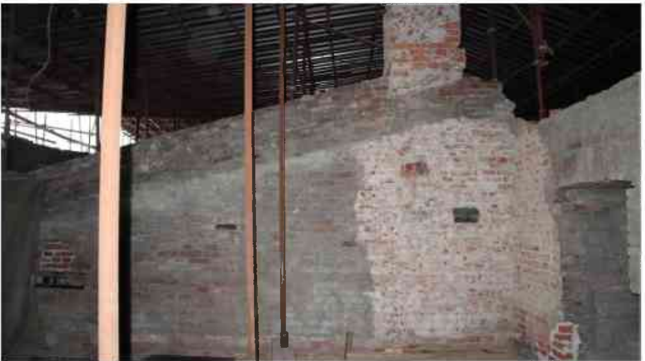
Фото 5.159. 5 этаж, чердачное помещение.
