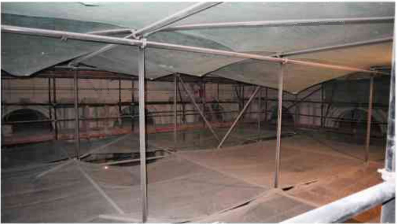
Фото 2.151. 2 этаж, помещение 22Н (19).*
