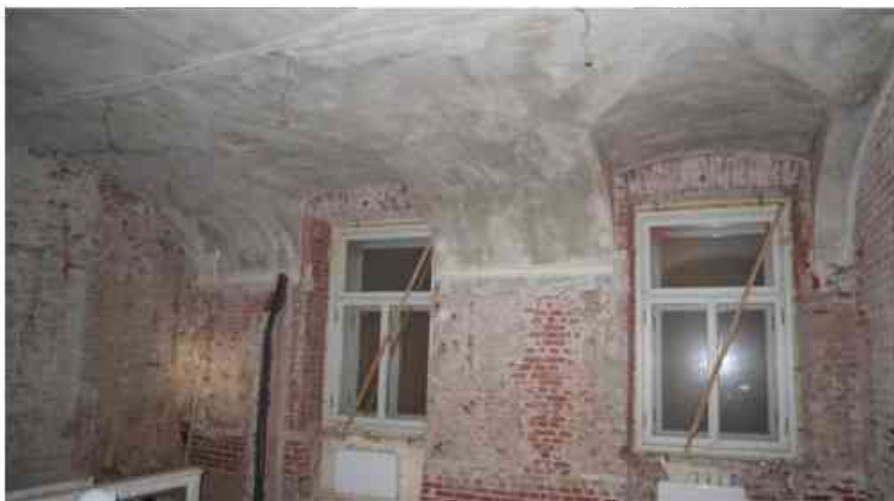
Фото 2.106. 2 этаж, помещение 22Н (44).
