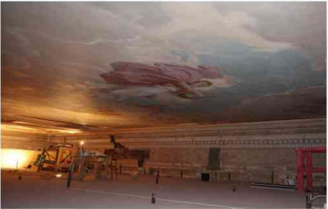
Фото 3.87. 3 этаж, помещение 28Н (2).*
