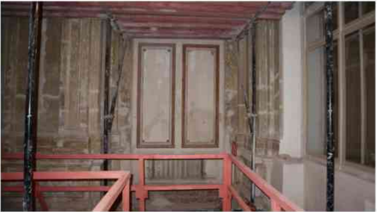
Фото 2.126. 2 этаж, помещение 22Н (19).
