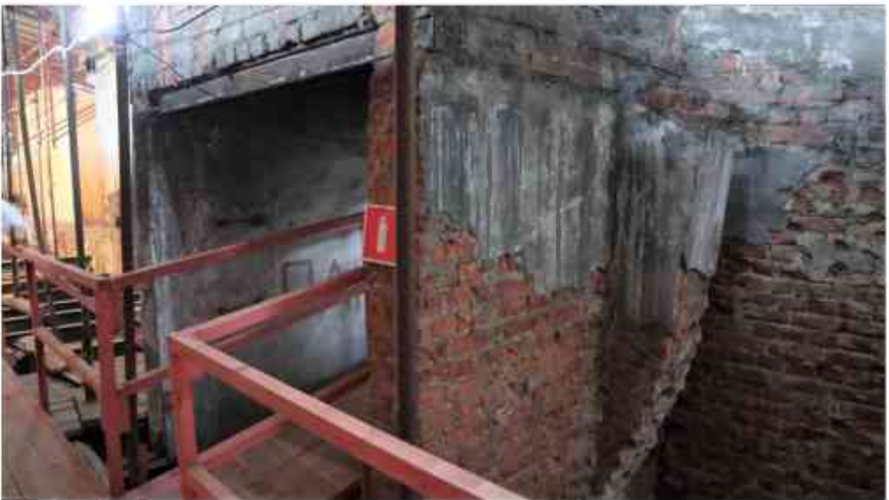
Фото 5.133. 5 этаж, коридор, помещения 34Н/37Н.
