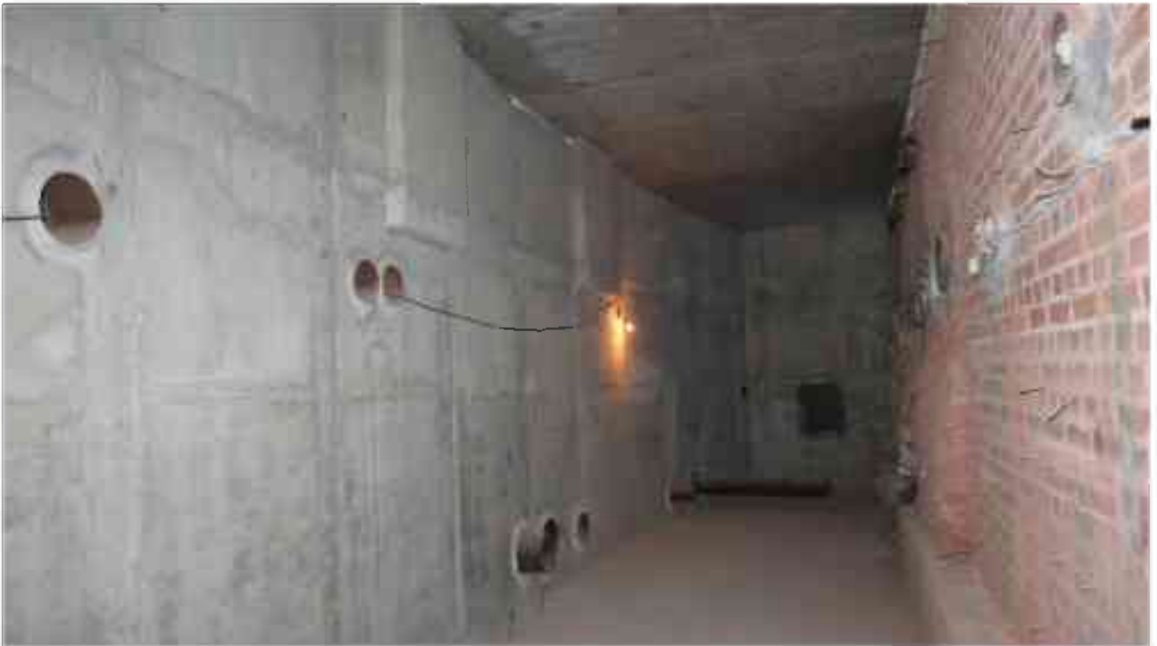
Фото п.33. Подвал, помещение 3Н (10-11).
