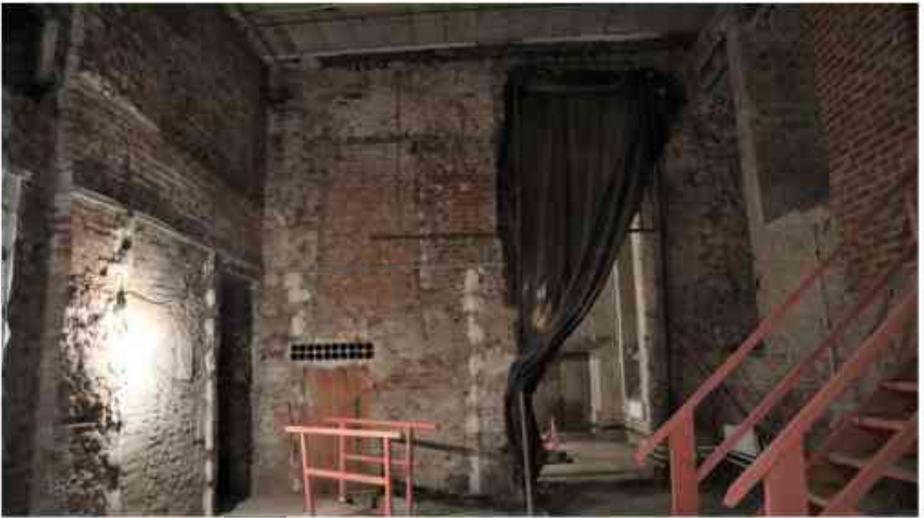
Фото п.55. Подвал, помещение 3Н (14).
