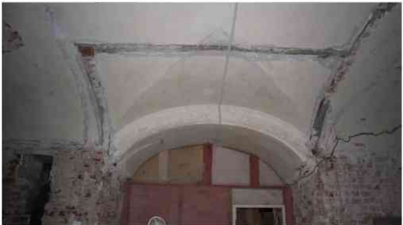
Фото 1.84. 1 этаж, помещение 14Н (27-28, 45).
