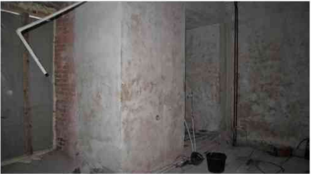
Фото 3.134. 3 этаж, помещение 26Н (2).
