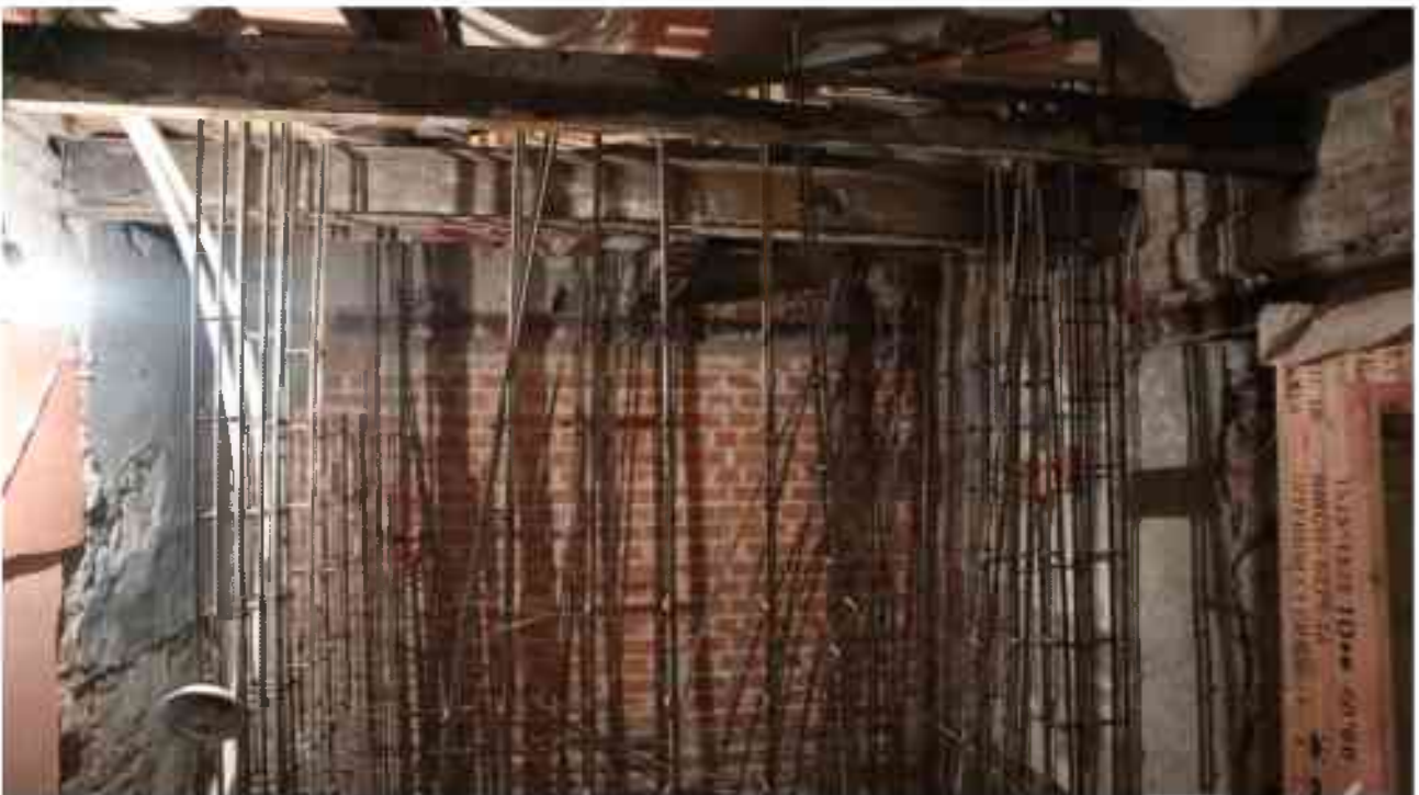
Фото п.323. Подвал, помещение 18Н (6).
