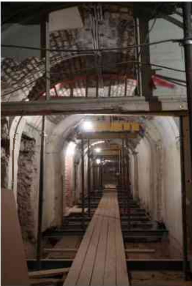
Фото 4.78. 4 этаж, коридор, помещение 33Н (2-3, 12-15).
