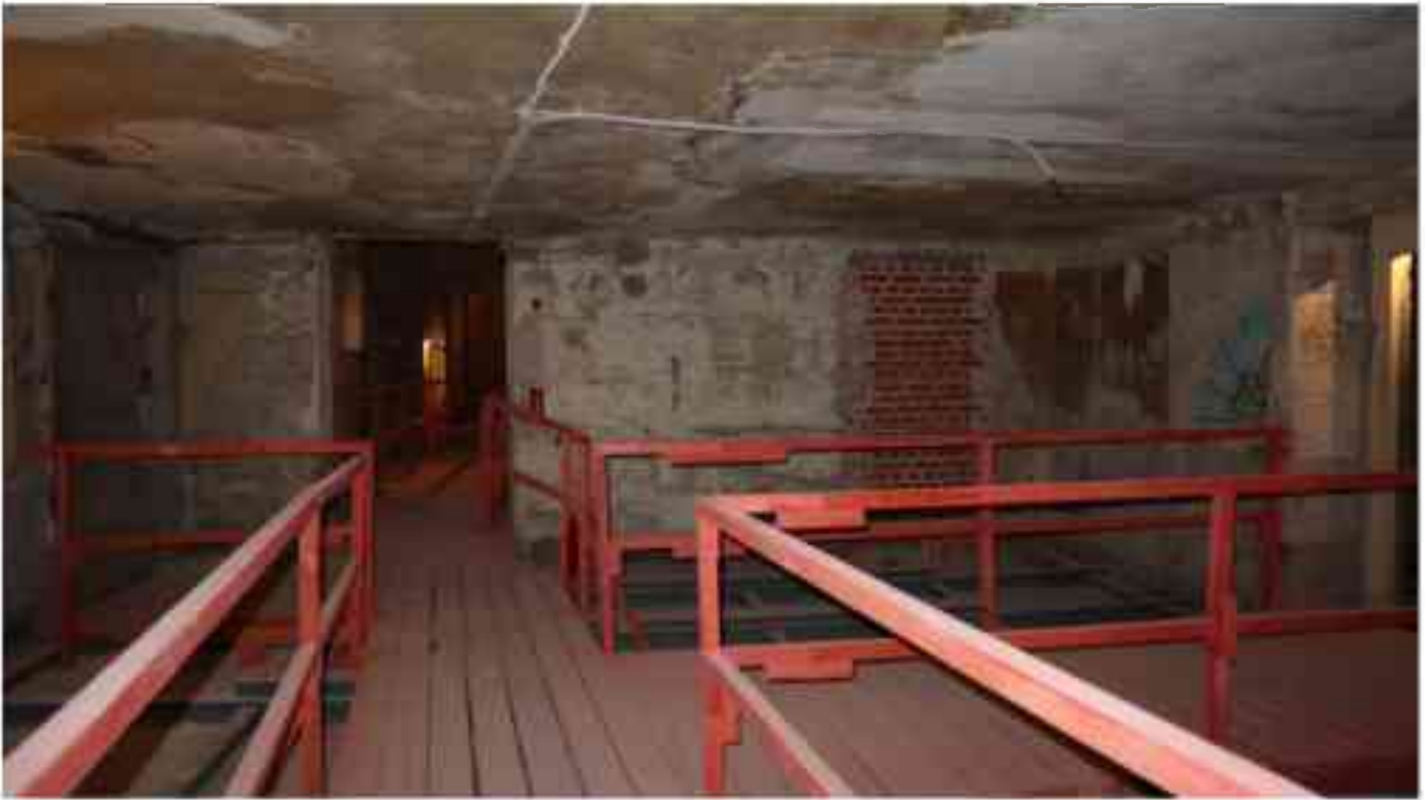
Фото 2.180. 2 этаж, помещение 22Н (11).
