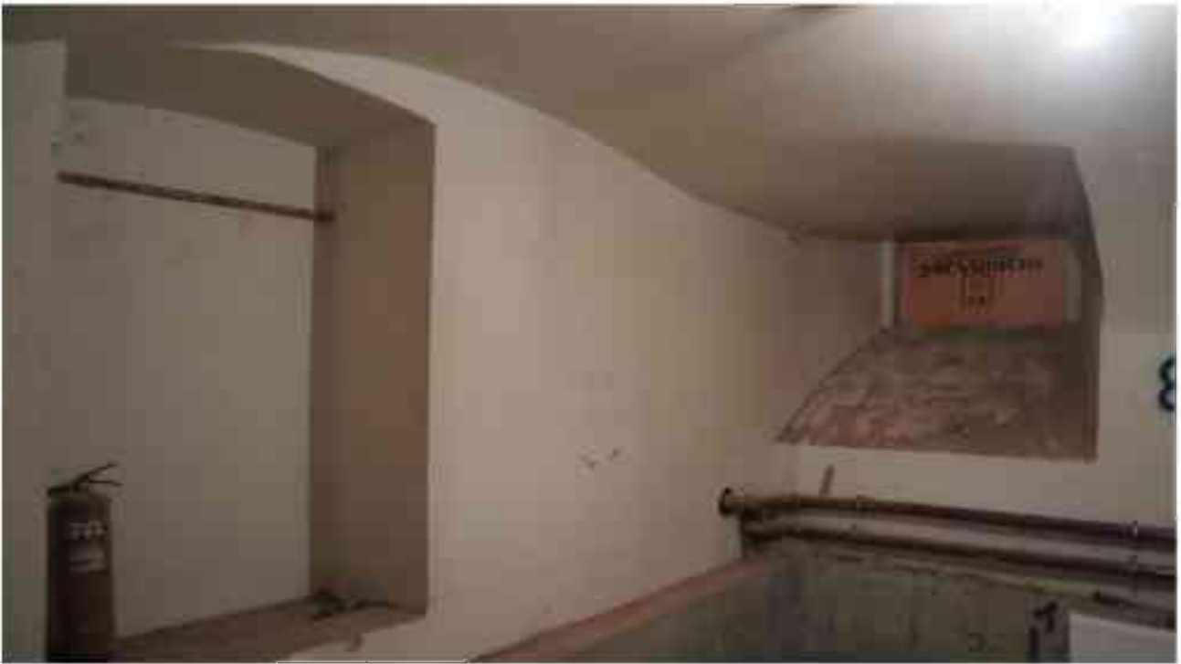
Фото п.162. Подвал, восточная часть помещения 9Н (13), разделенного перегородкой.
