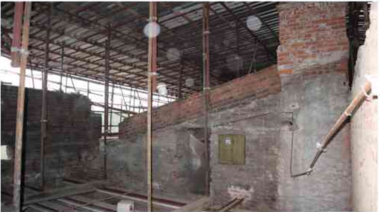
Фото 5.173. 5 этаж, чердачное помещение.
