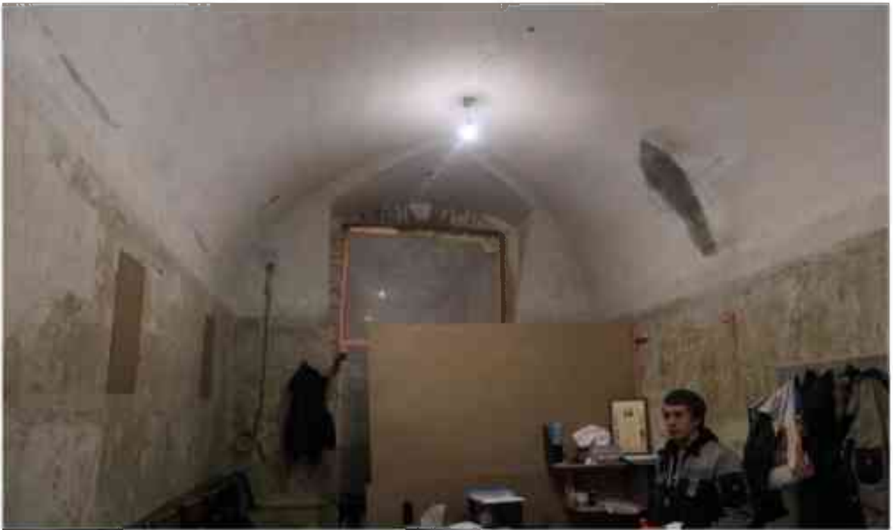
Фото 3.25. 3 этаж, помещение 28Н (22).
