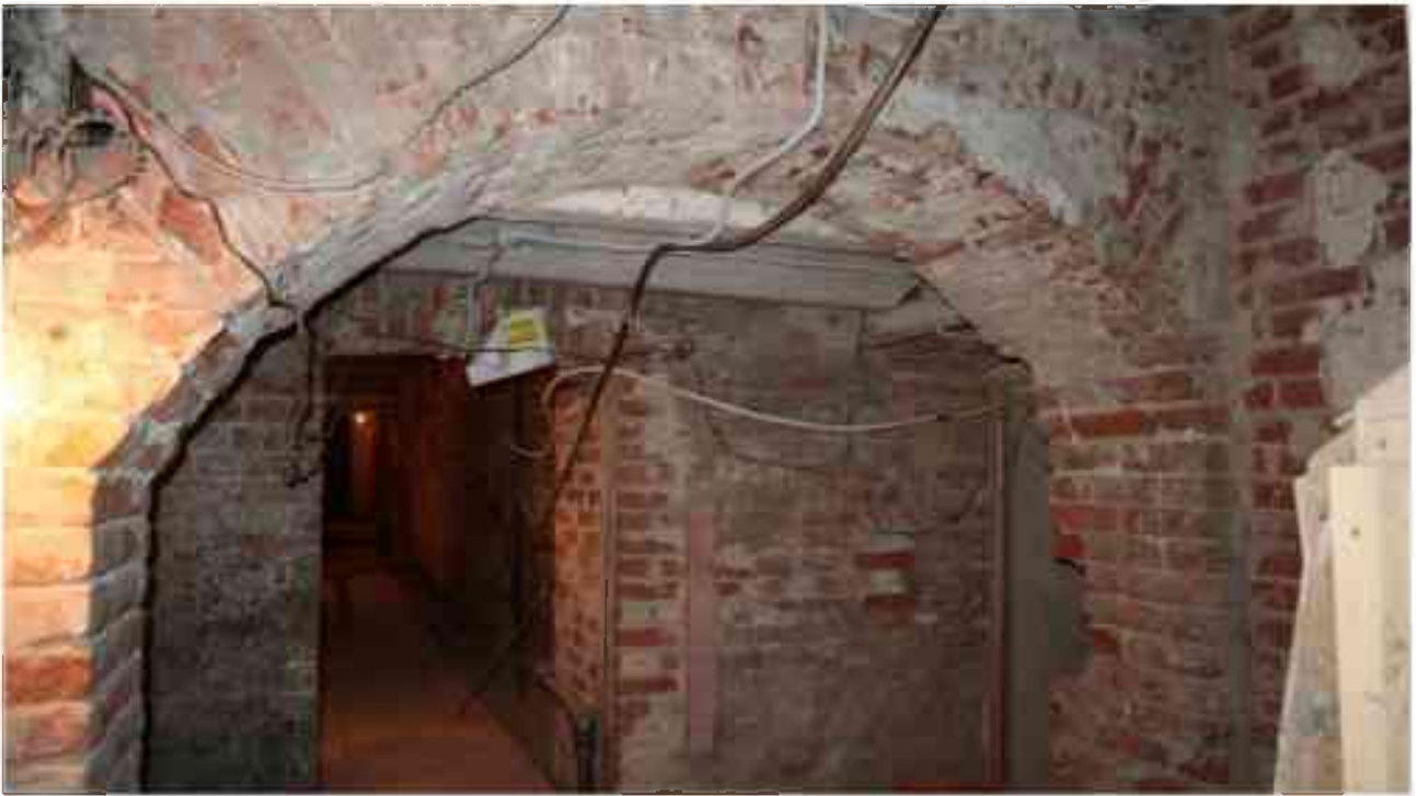
Фото п.3. Подвал, лестница Л-6.
