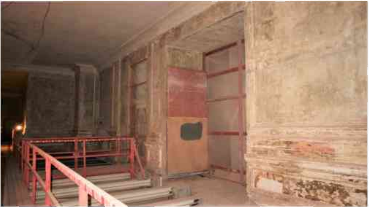
Фото 2.82. 2 этаж, помещение 22Н (28).
