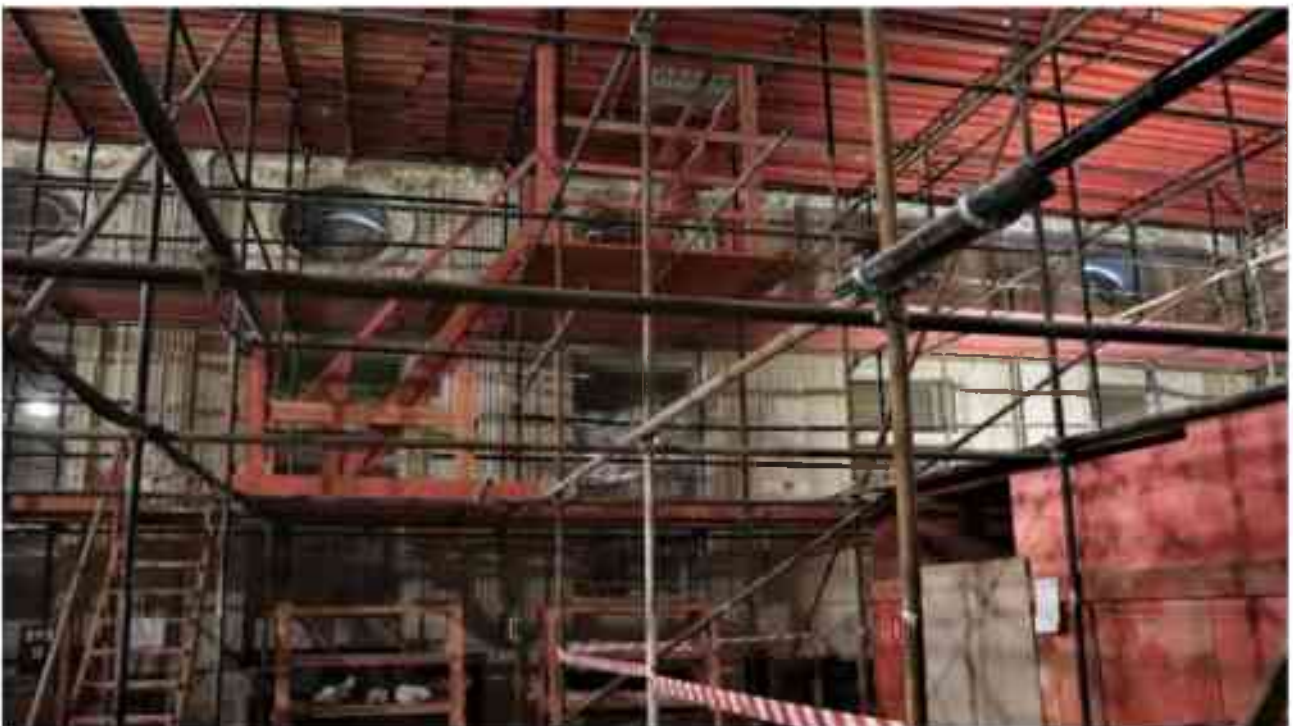
Фото 3.76. 3 этаж, помещение 28Н (2).
