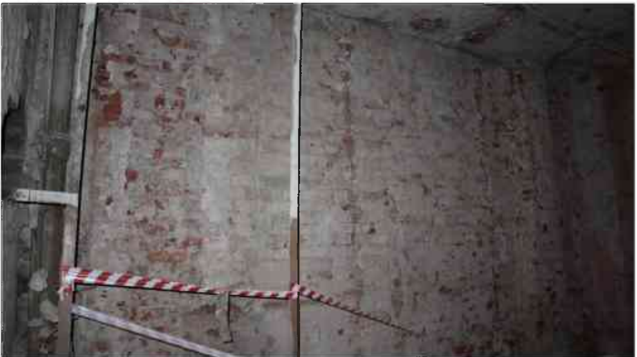
Фото 4.120. 4 этаж, коридор, помещение 29Н (3-4).
