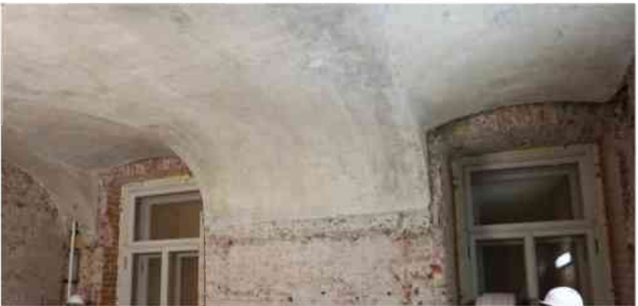
Фото 2.16. 2 этаж, помещение 22Н (47).
