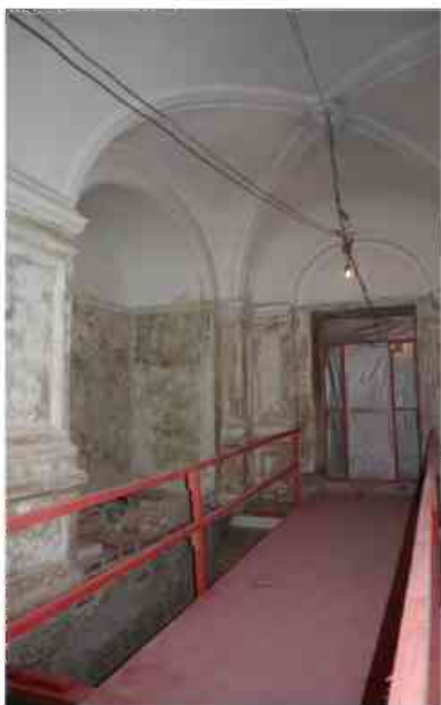
Фото 4.162. 4 этаж, помещение 30Н (4).
