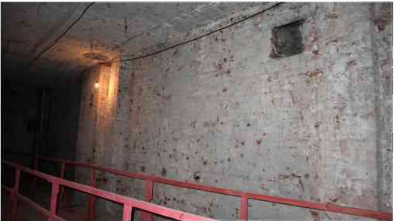
Фото 4.118. 4 этаж, коридор, помещение 29Н (3-4).
