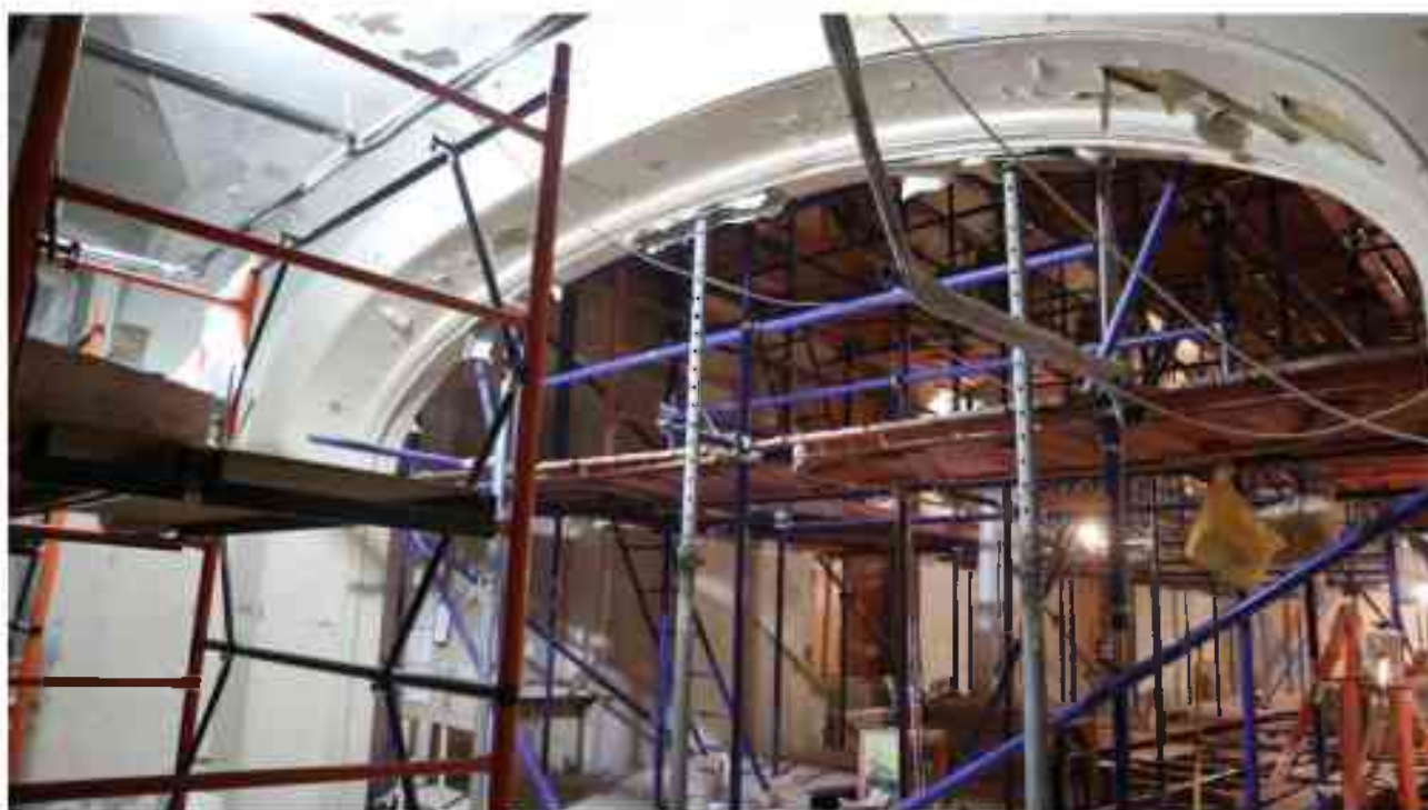
Фото 3.39. 3 этаж, помещение 28Н (18).
