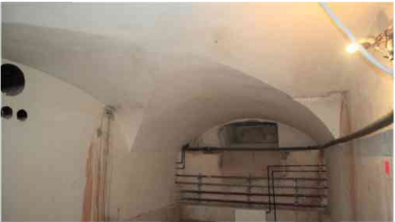
Фото п.257. Подвал, помещение 6Н (4).
