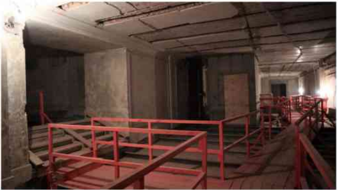
Фото 3.113. 3 этаж, помещение 25Н (1).
