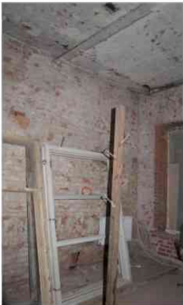
Фото 1.226. 1 этаж, помещение 15Н (7-11).
