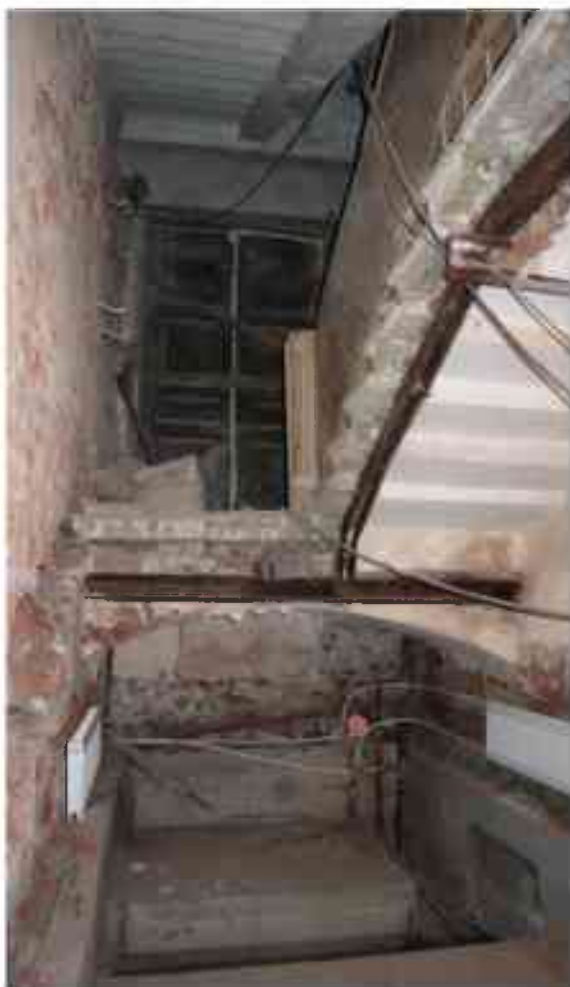
Фото п.222. Подвал, помещение 9Н (2), лестница Л-17.
