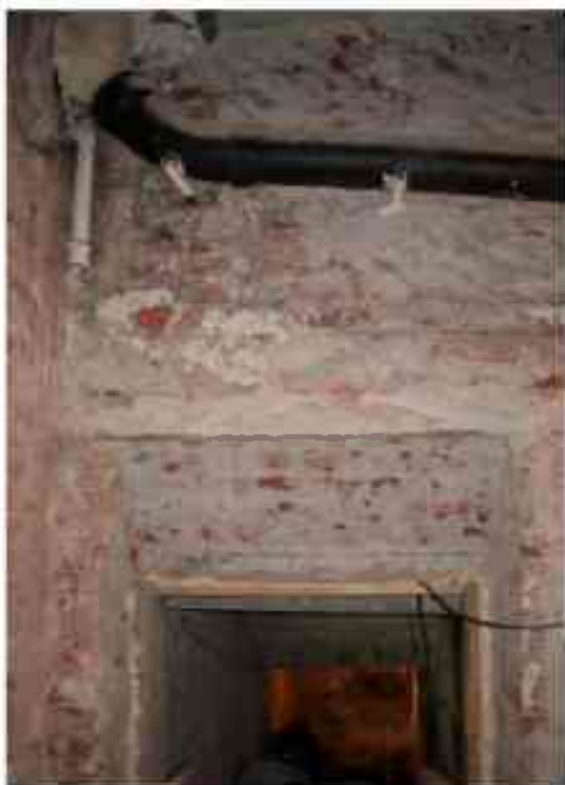
Фото 1.168. 1 этаж, помещение 20Н (1-2).
