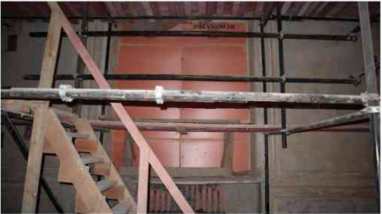
Фото 2.68. 2 этаж, помещение 22Н (31).
