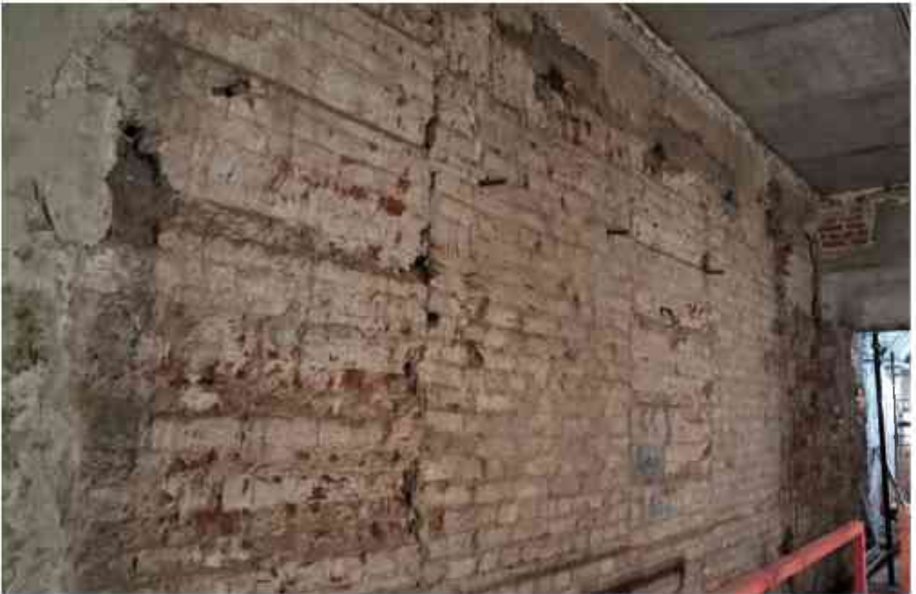
Фото 1.211. 1 этаж, помещение 15Н (5-6).
