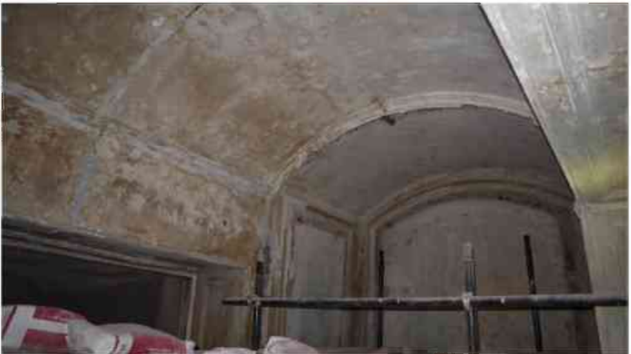
Фото 2.76. 2 этаж, помещение 22Н (31).*
