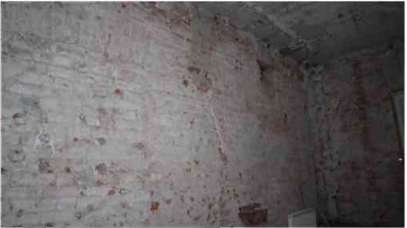
Фото 4.111. 4 этаж, коридор, помещение 29Н (1-2).
