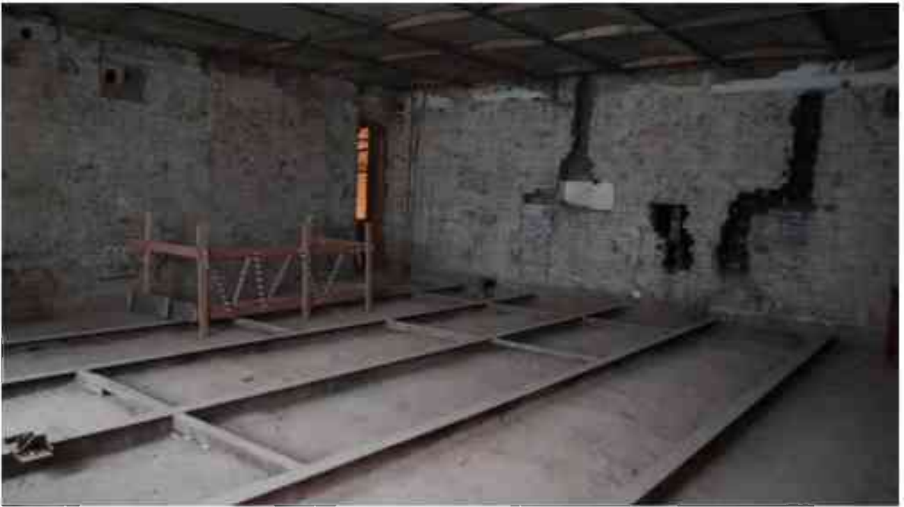
Фото 4.24. 4 этаж, помещение 33Н (33).
