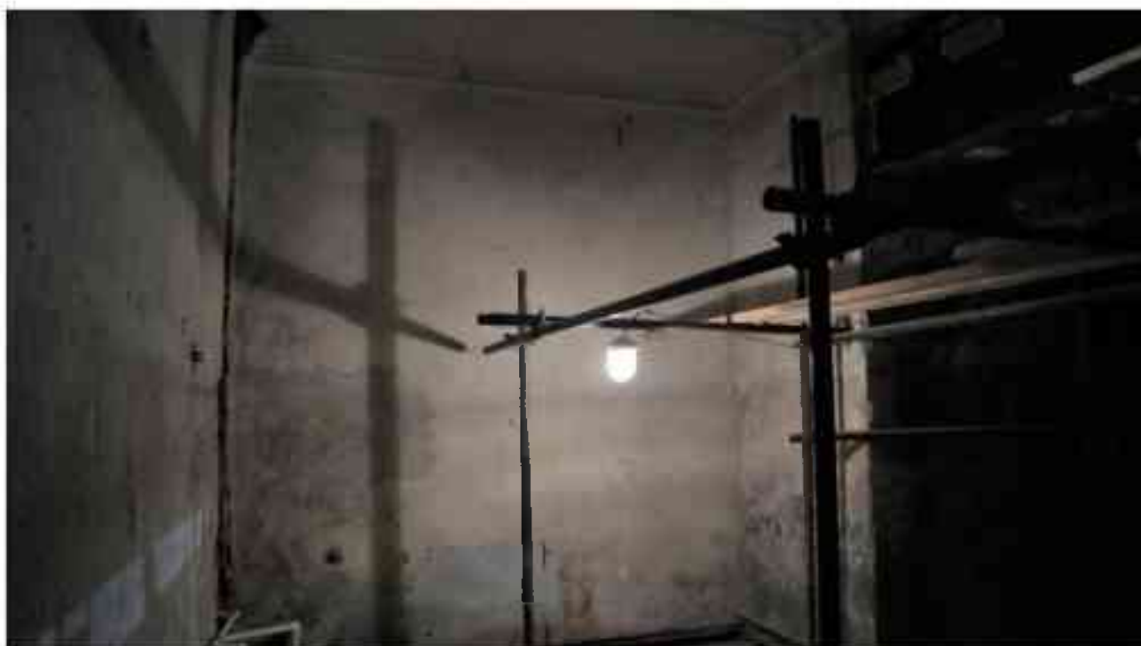
Фото 1.343. 1 этаж, помещение 13Н (31).
