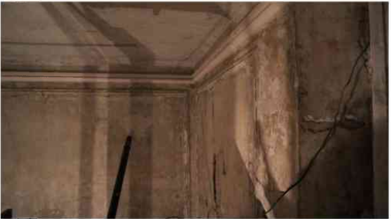
Фото 5.112. 5 этаж, лестница Л-10.
