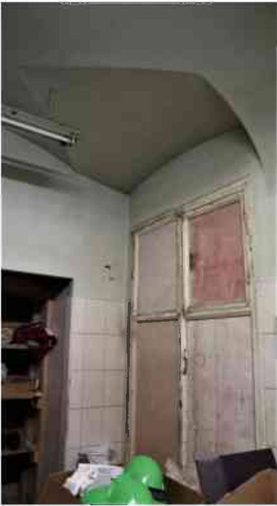
Фото 1.48. 1 этаж, помещение 14Н (7).
