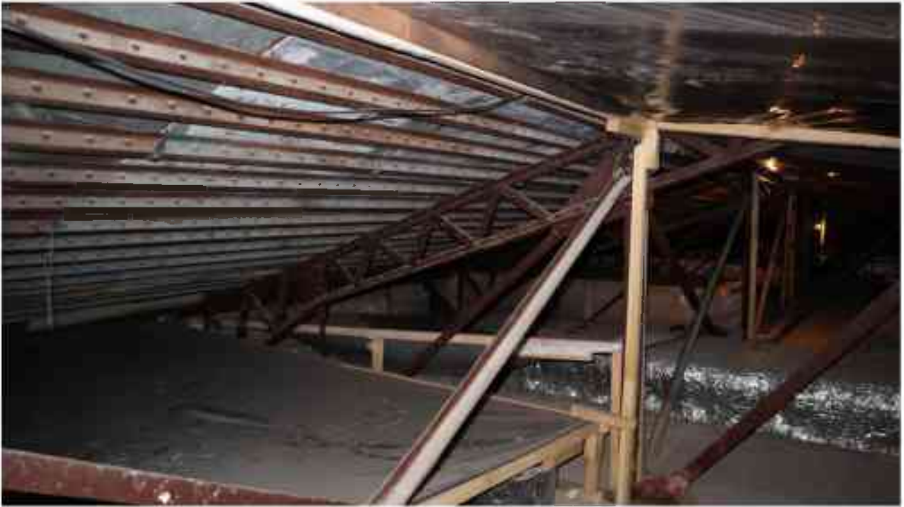
Фото 5.118. Чердак уровня 5 этажа.
