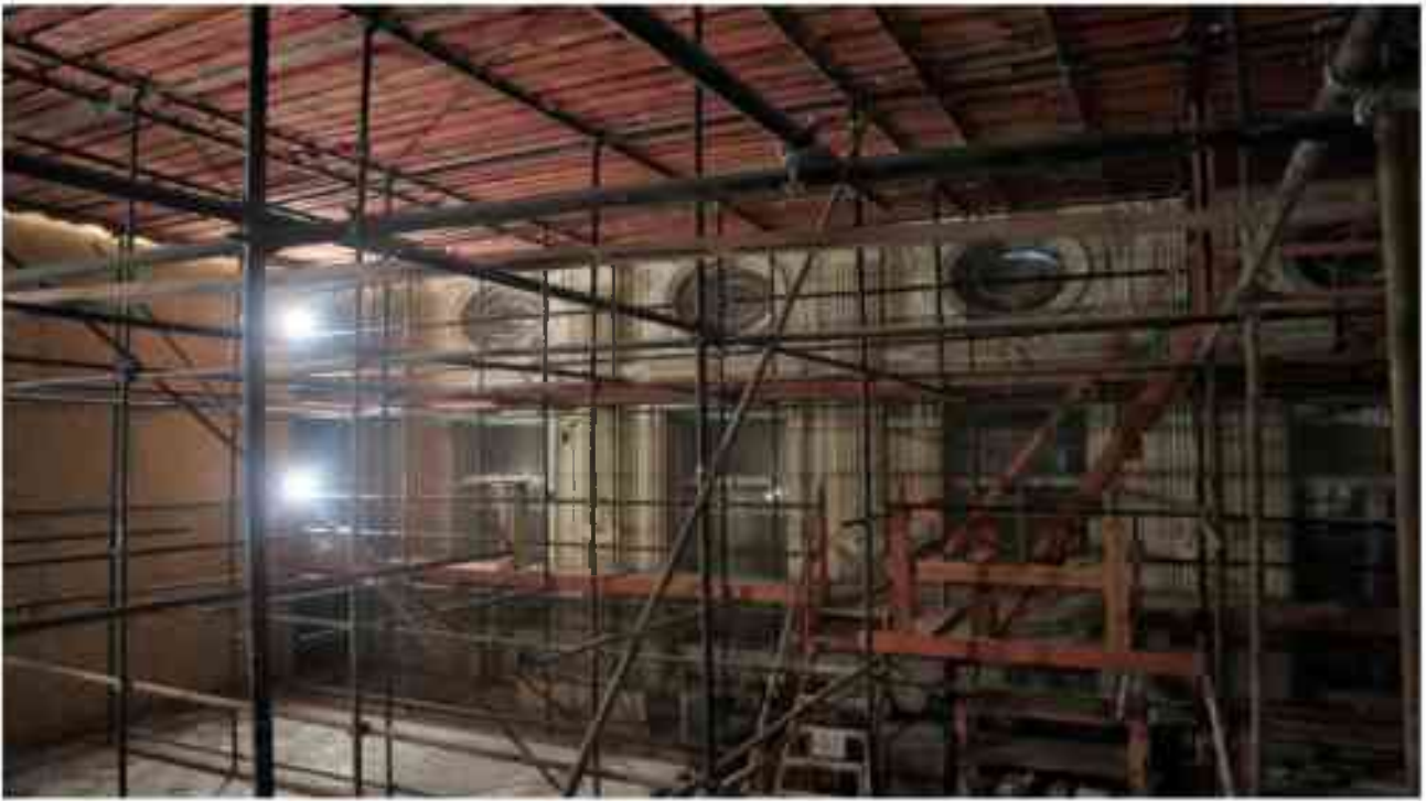
Фото 3.77. 3 этаж, помещение 28Н (2).*
