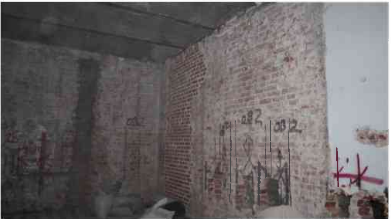
Фото 3.30. 3 этаж, помещение 28Н (29-35).
