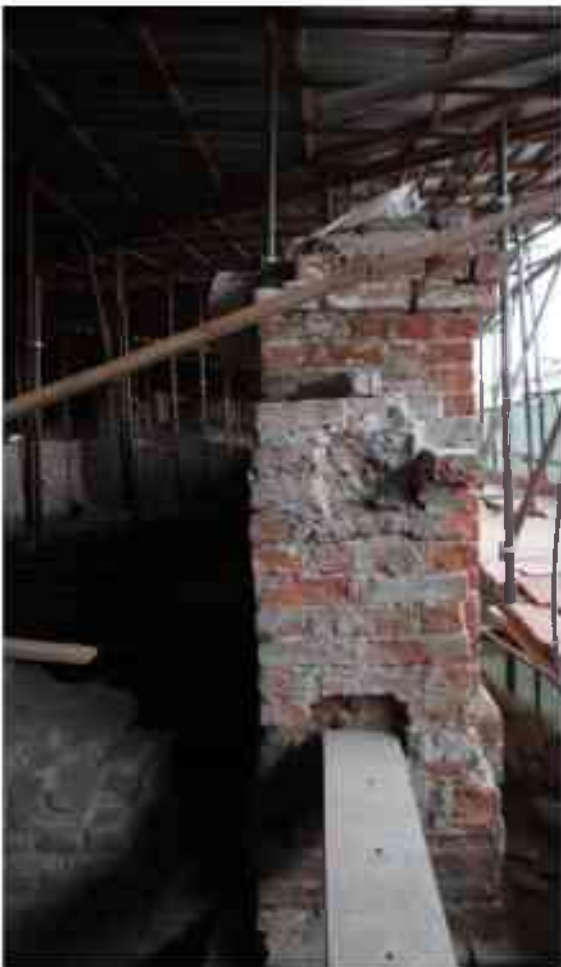
Фото 5.165. 5 этаж, чердачное помещение.
