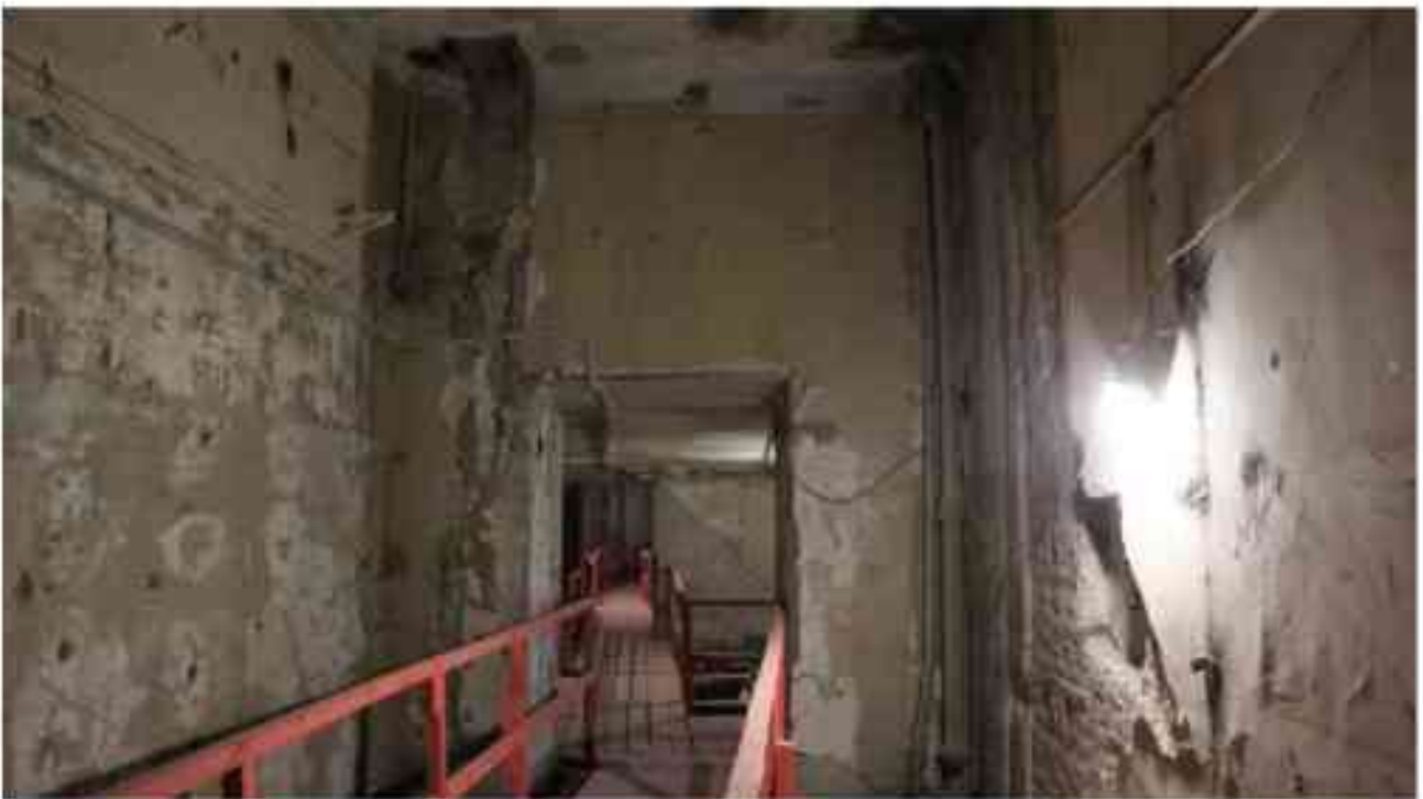
Фото 2.190. 2 этаж, помещение 22Н (10).
