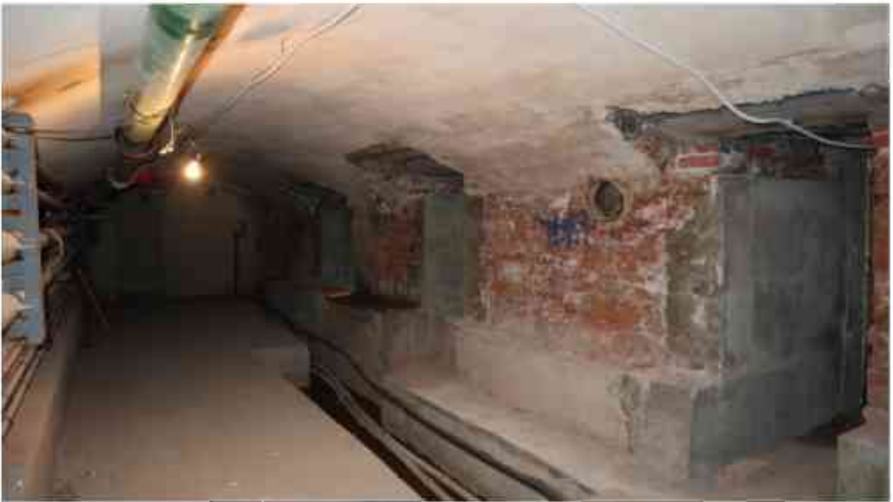
Фото п.188. Подвал, помещение 9Н (21).
