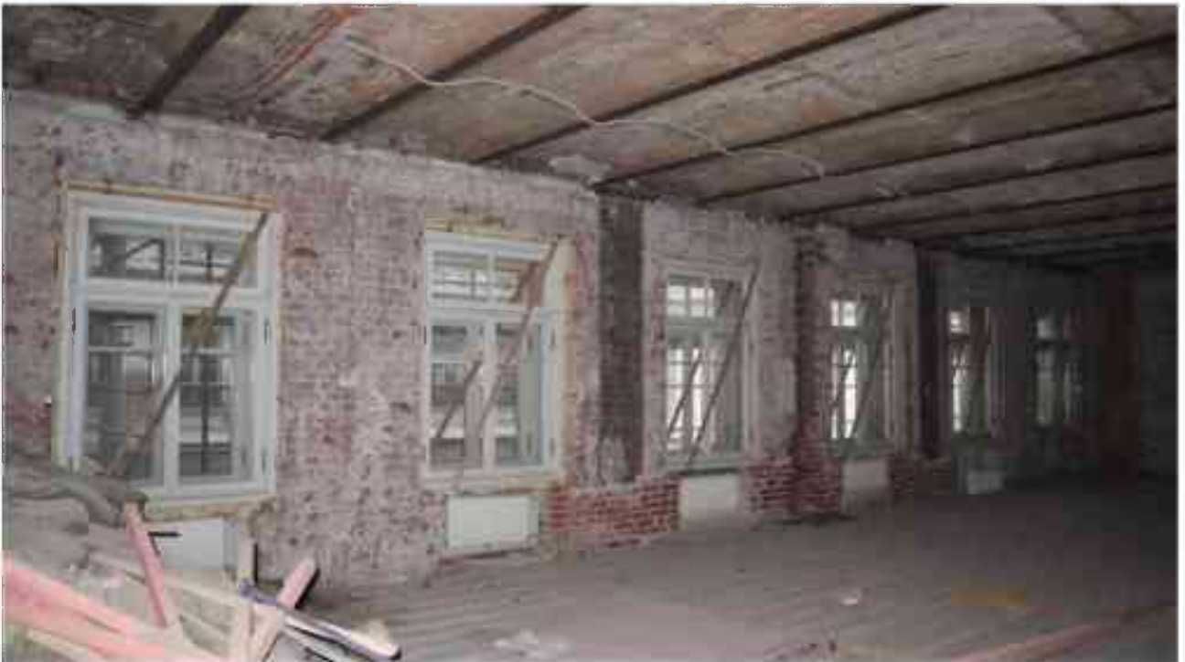
Фото 4.48. 4 этаж, помещение 33Н (23-28).
