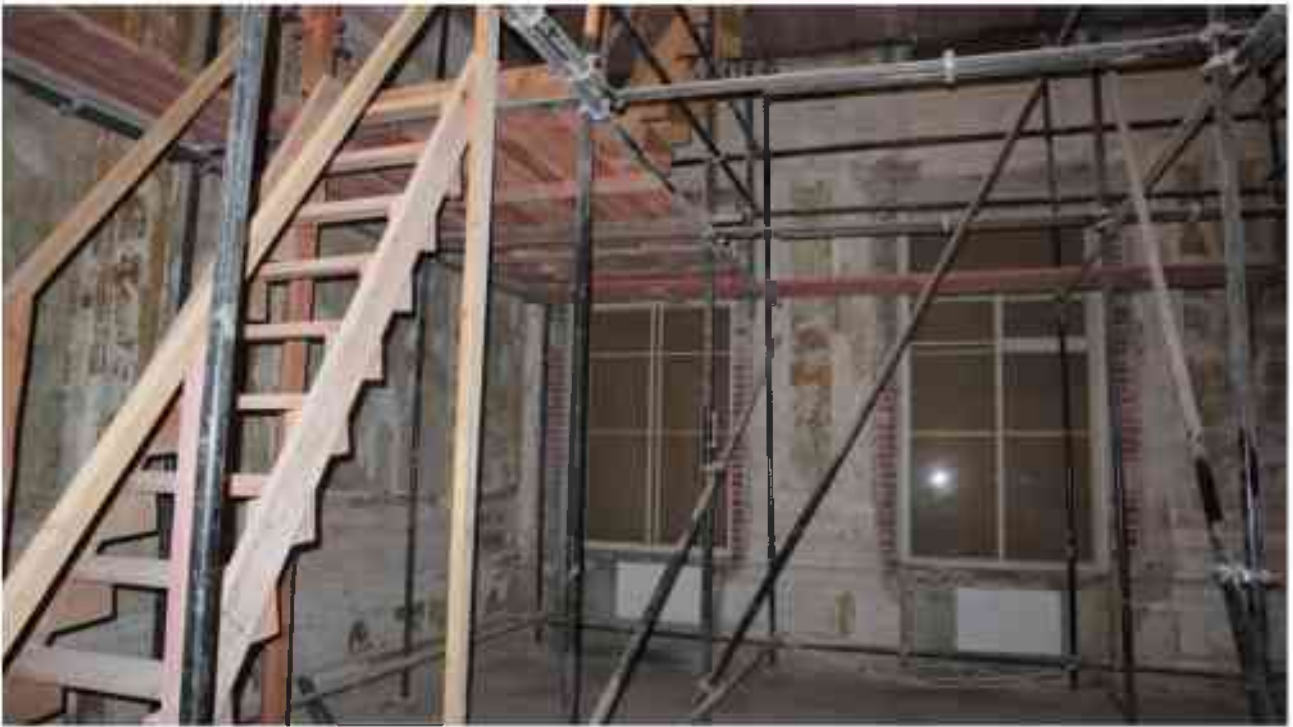
Фото 2.131. 2 этаж, помещение 22Н (18).
