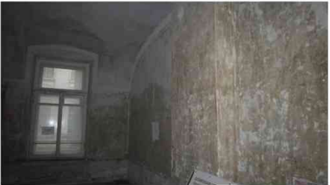
Фото 3.32. 3 этаж, помещение 28Н (28).
