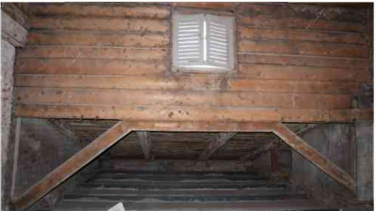
Фото 6.57. 6 этаж, чердачное помещение.
