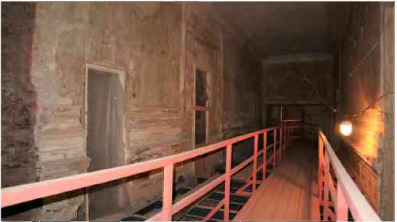
Фото 2.84. 2 этаж, помещение 22Н (28).
