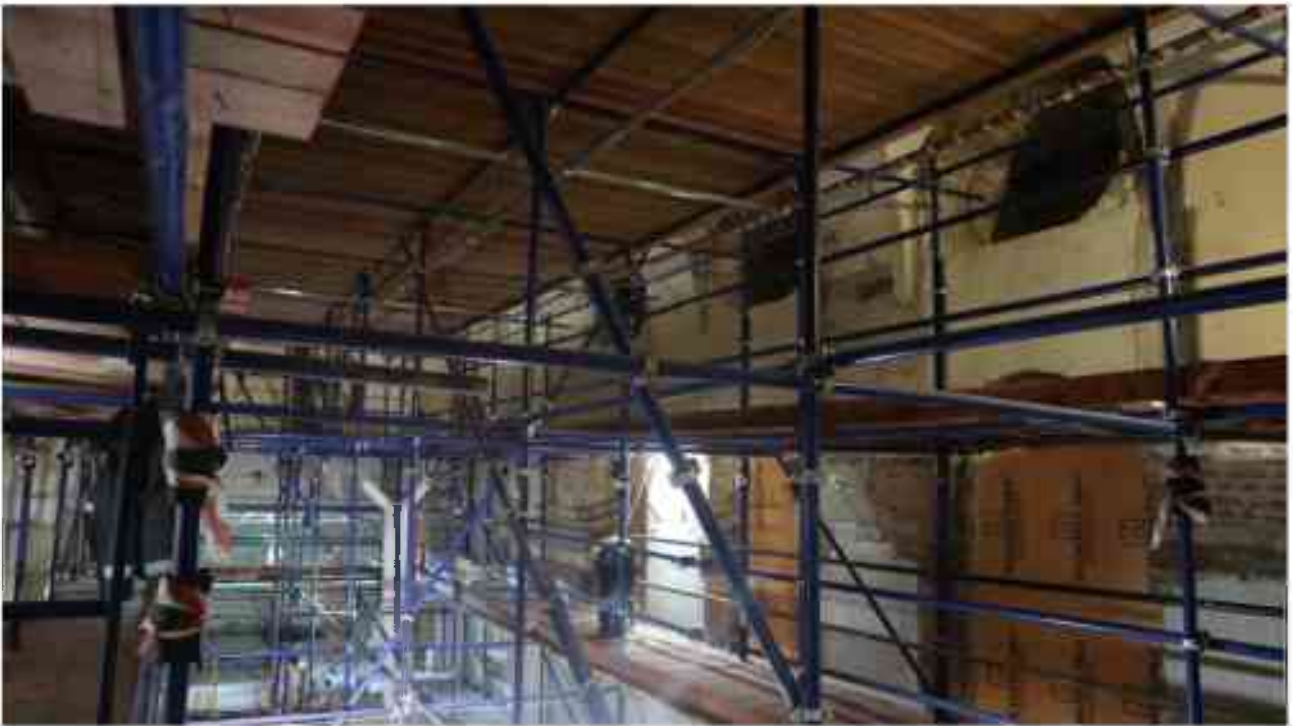
Фото 3.47. 3 этаж, помещение 28Н (20-21).*
