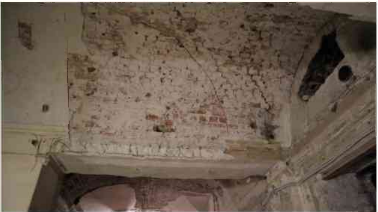
Фото 2.204. 2 этаж, помещение 22Н (10).
