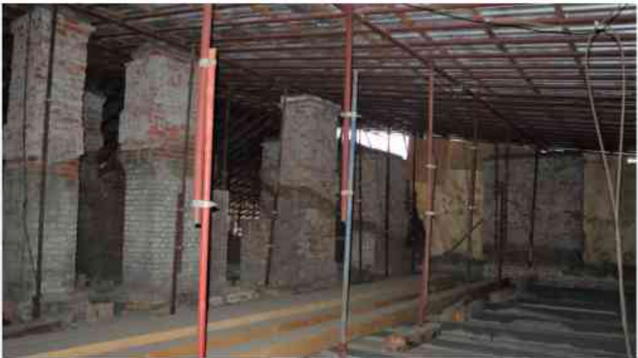
Фото 6.45. 6 этаж, чердачное помещение.
