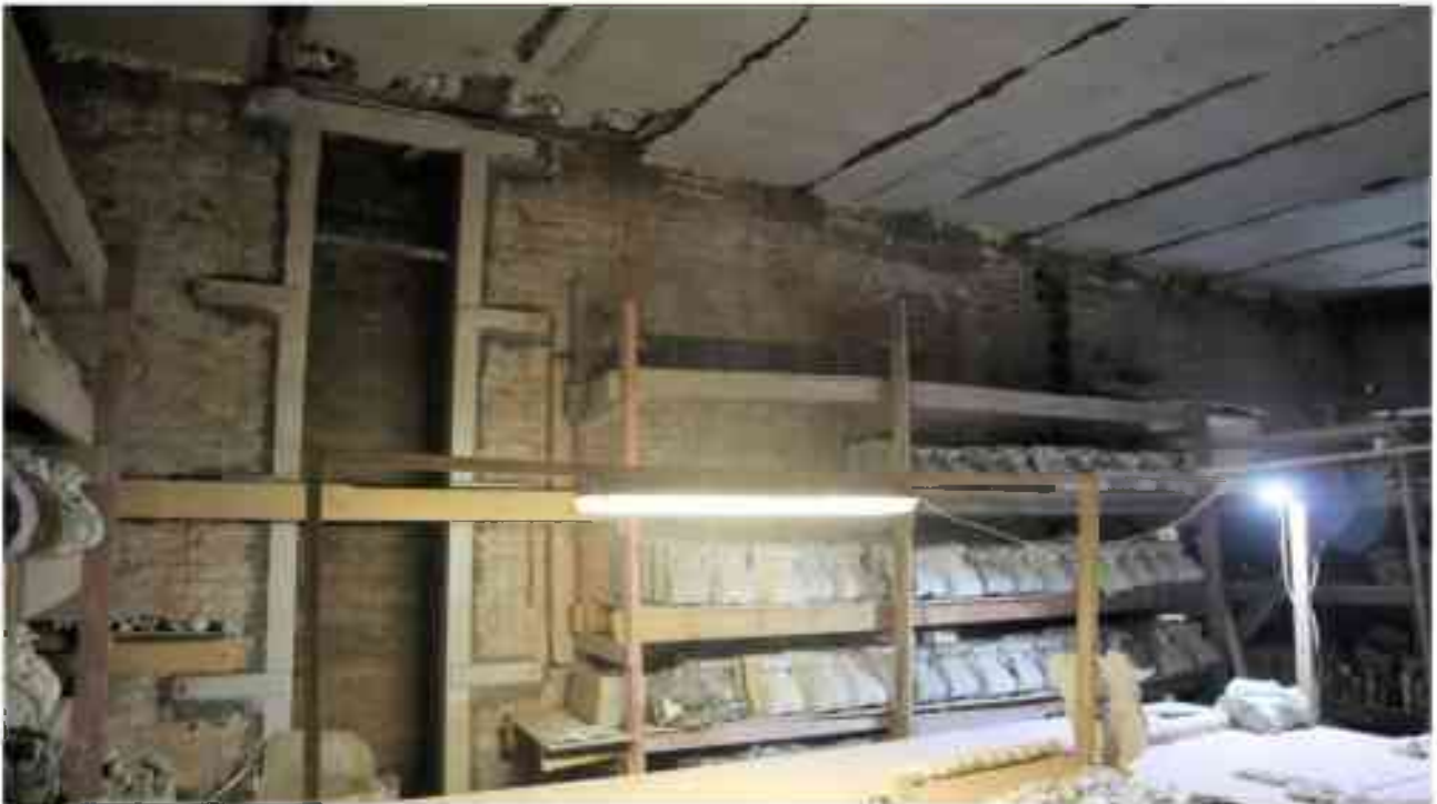
Фото 3.10. 3 этаж, помещение 28Н (26).
