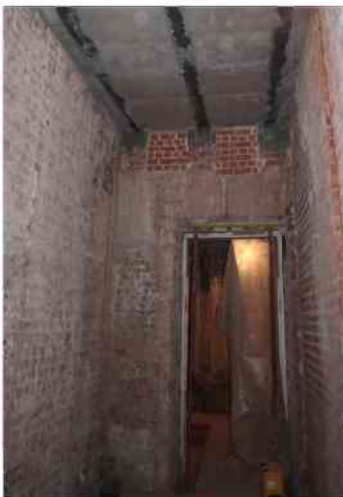
Фото 4.66. 4 этаж, помещение 33Н (50).
