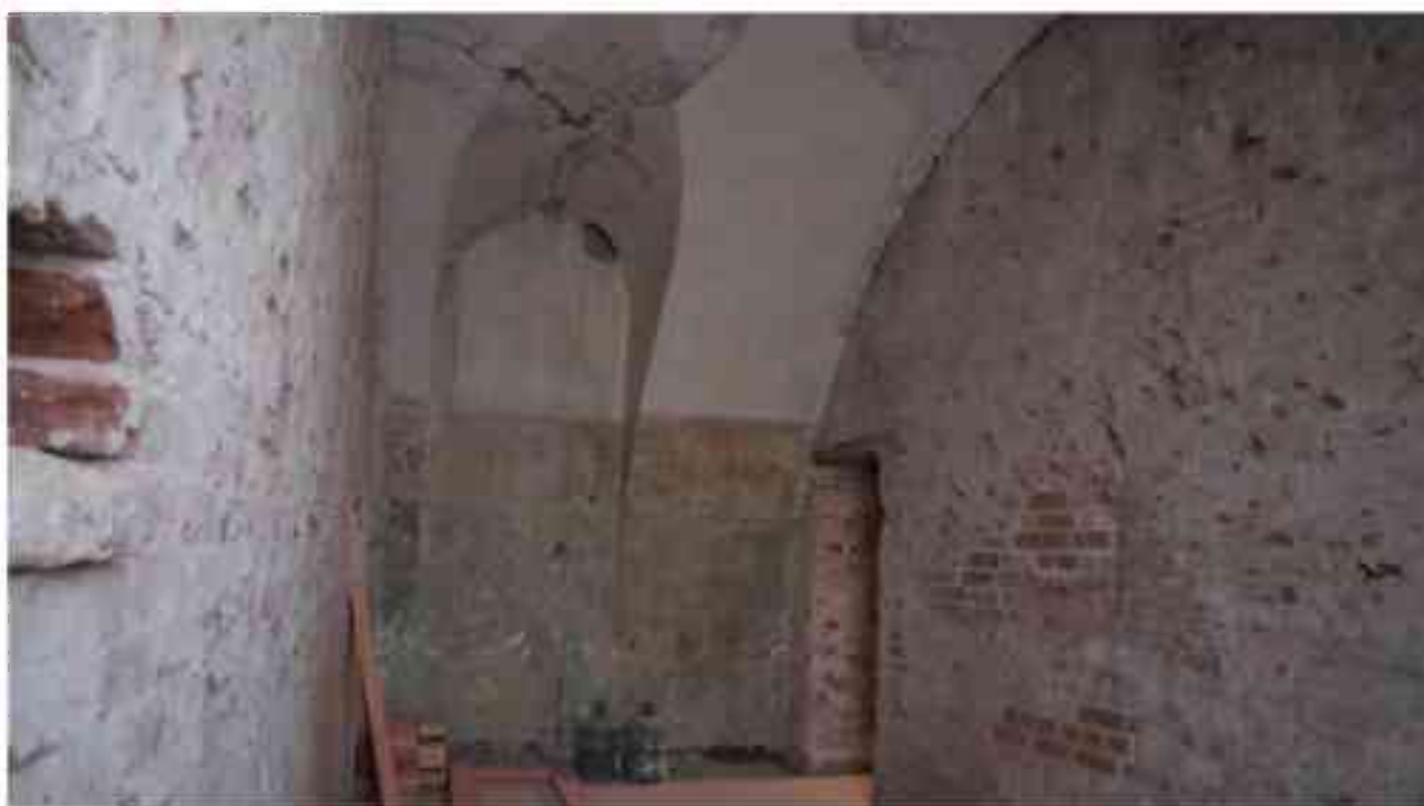
Фото 3.105. 3 этаж, помещение 28Н (6).
