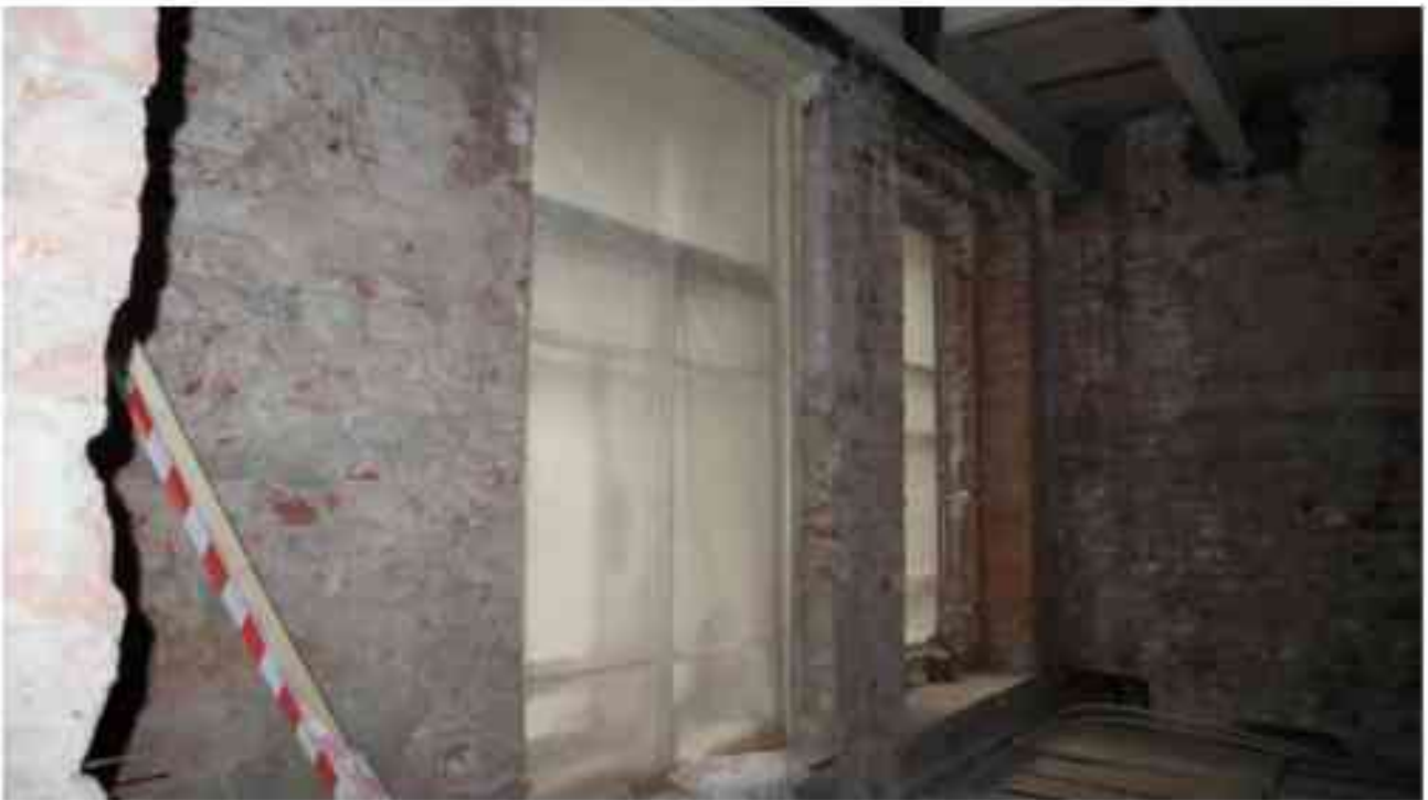
Фото 3.131. 3 этаж, помещение 25Н (6-7).
