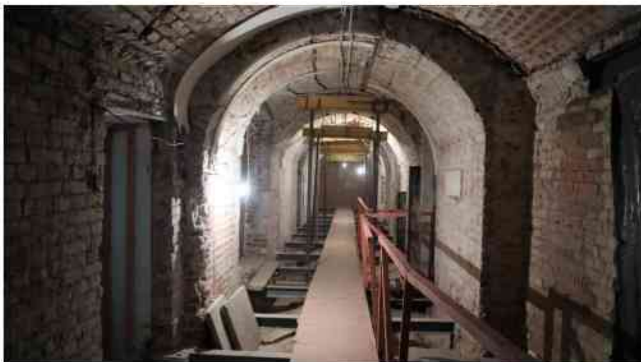
Фото 5.10. 5 этаж, помещение 37Н (1).
