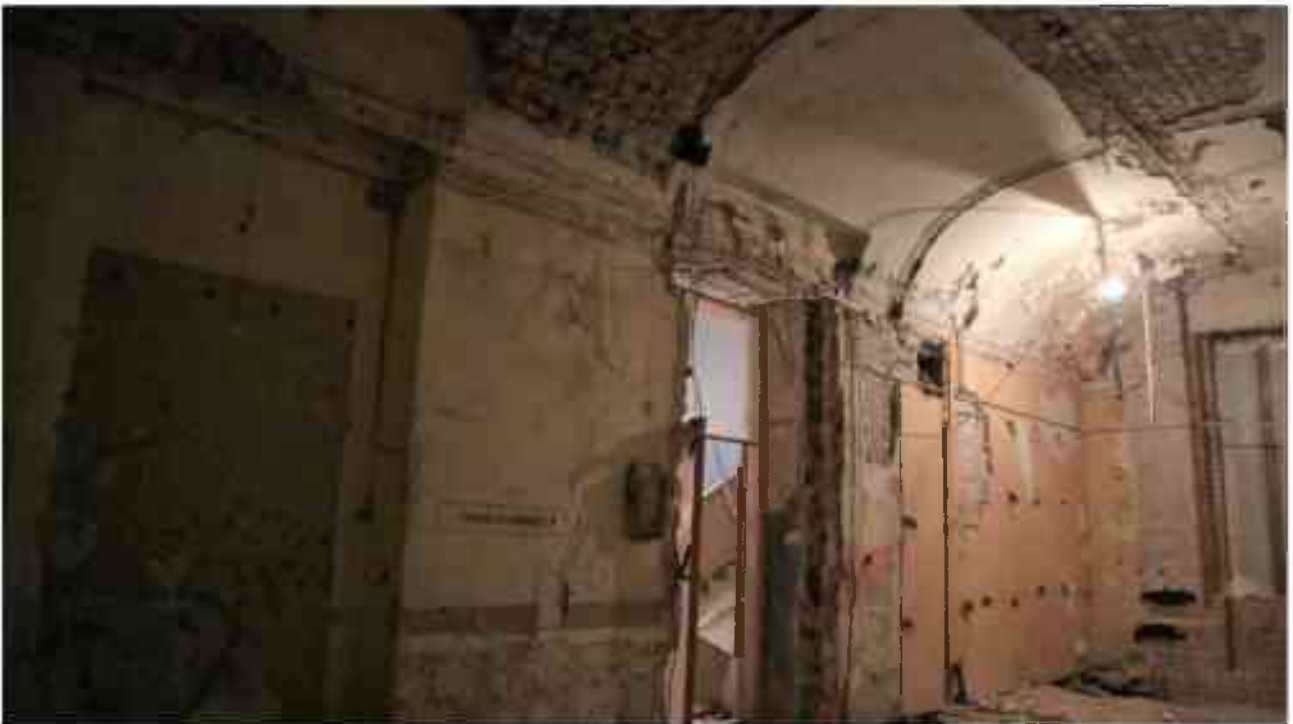
Фото 2.206. 2 этаж, помещение 22Н (10).
