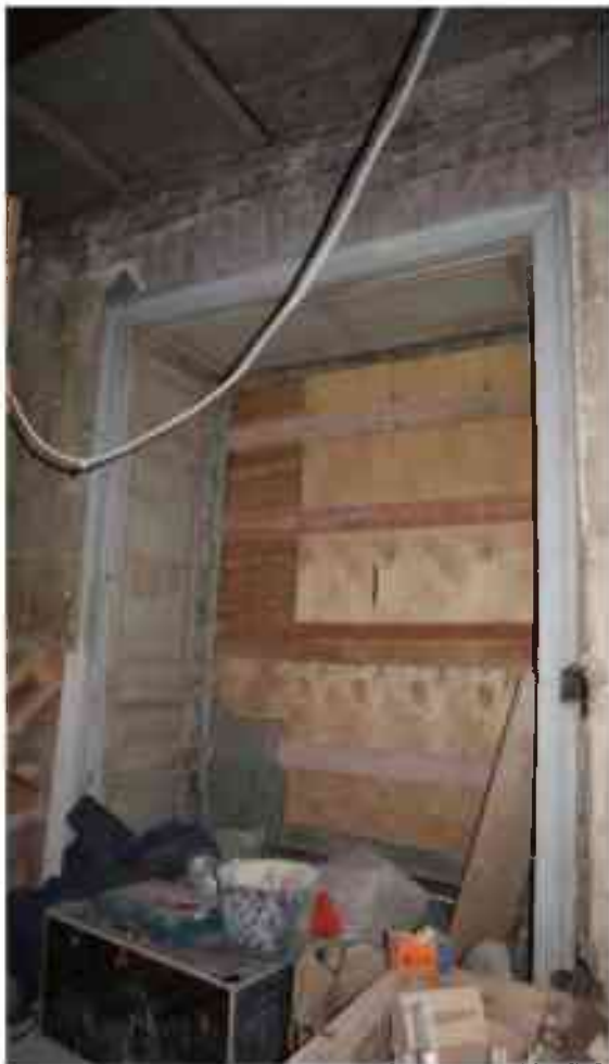
Фото 2.101. 2 этаж, помещение 22Н (33-35, 38-40).
