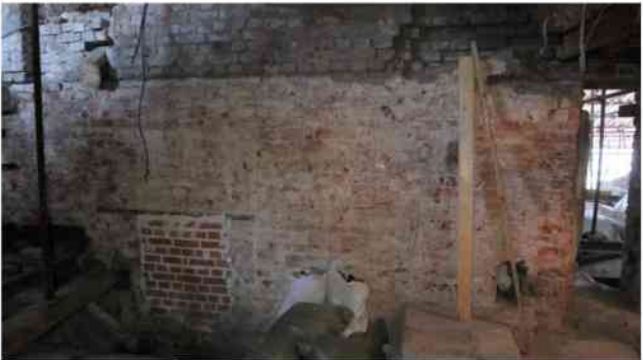
Фото 6.27. 6 этаж, чердачное помещение.
