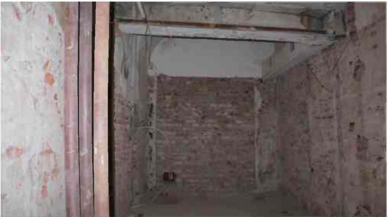
Фото 2.238. 2 этаж, помещение 22Н (58, 81).
