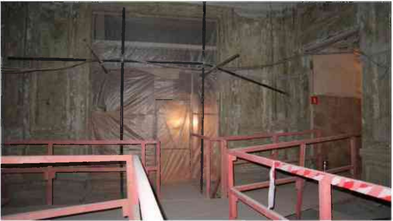
Фото 2.80. 2 этаж, помещение 22Н (28).
