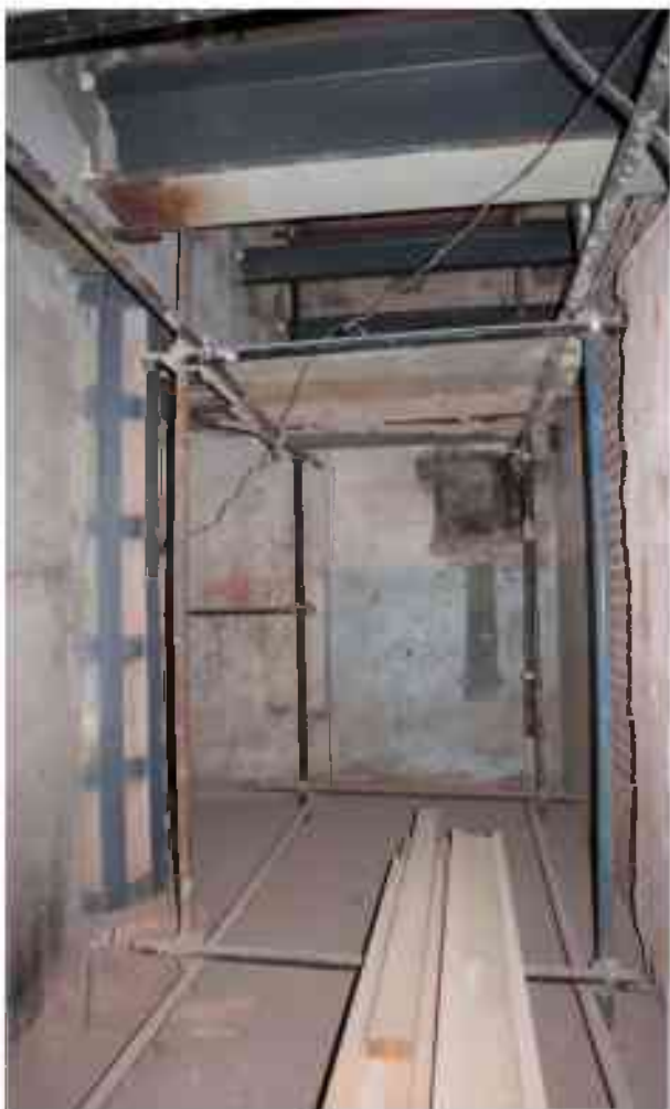
Фото 1.342. 1 этаж, помещение 13Н (32).
