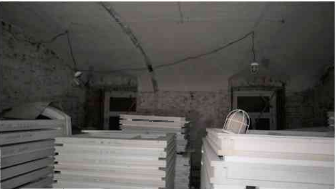
Фото 1.79. 1 этаж, помещение 14Н (27-28, 45).
