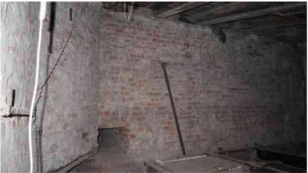
Фото 6.15. 6 этаж, чердачное помещение.
