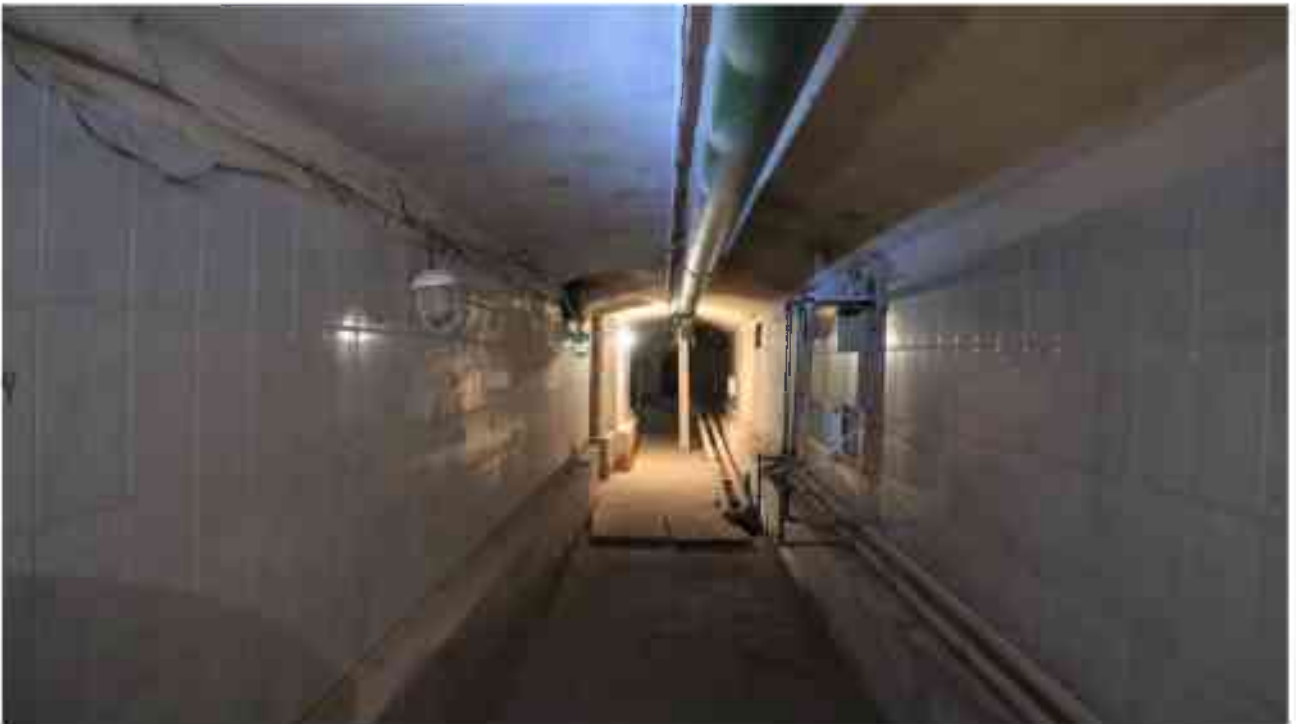
Фото п.275. Подвал, помещение 6Н (8).
