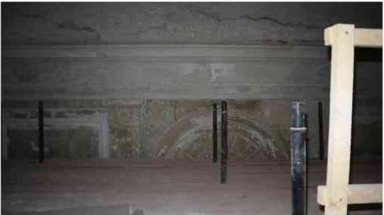
Фото 3.151. 3 этаж, помещение 25Н (11).*
