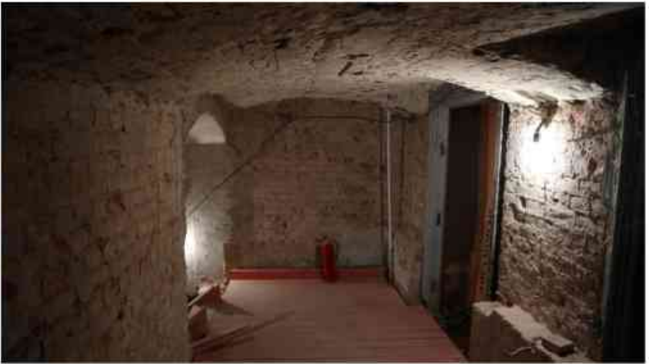
Фото 1.158. 1 этаж, помещение 10Н (1-3).
