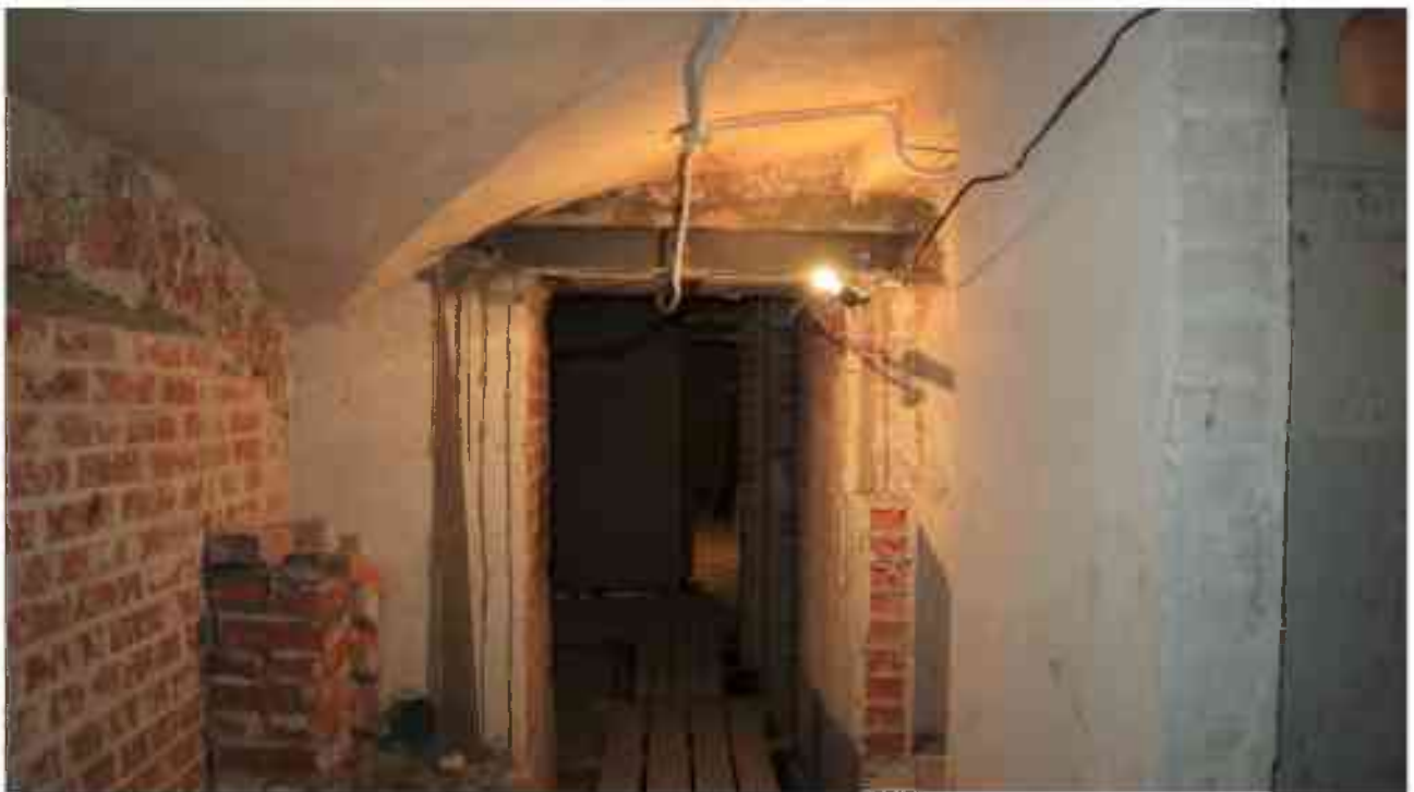
Фото п.196. Подвал, помещение 9Н (21).
