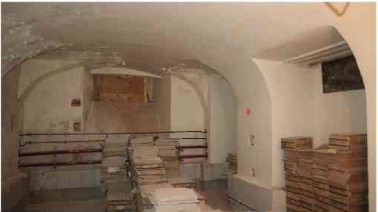
Фото п.149. Подвал, помещение 9Н (17).
