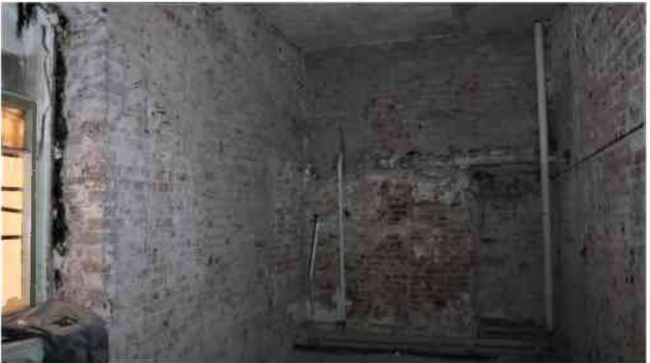
Фото 4.29. 4 этаж, помещение 33Н (33).
