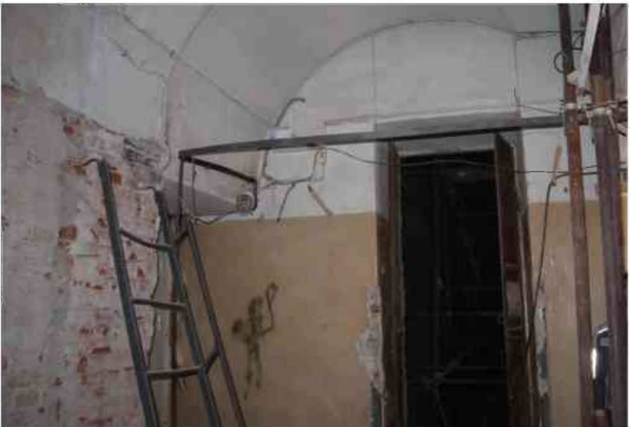
Фото 2.240. 2 этаж, помещение 22Н (58, 81).
