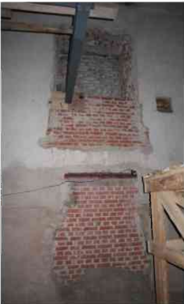
Фото п.331. Подвал, помещение 1Н (4-8).
