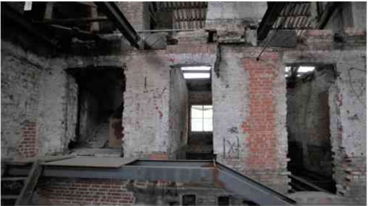
Фото 5.145. 5 этаж, жилой блок, на плане ПИБ 2000г. обозначен как квартиры, помещение (9-19).
