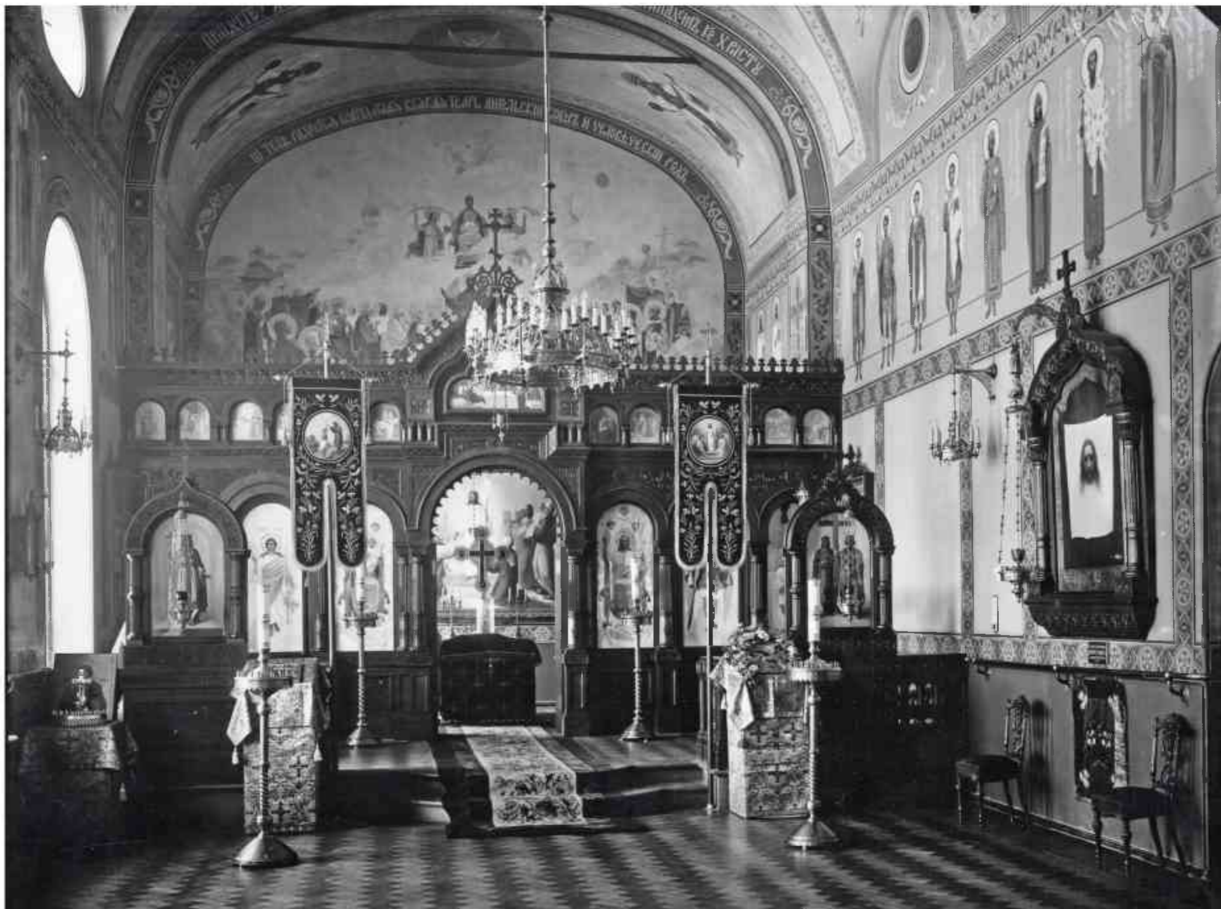
Ил. 131. Петербургская консерватория. Театральная пл., 3. Внутренний вид церкви Рождества Пресвятой Богородицы при консерватории. Гр. инж. Николая В. В. 1891-1896 гг. Дата съемки: 1912 г. Автор съемки: фотоателье Буллы. ЦГА КФФД. Е 4673.
