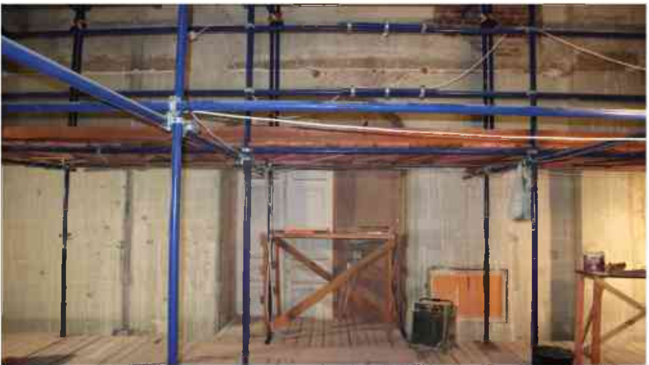
Фото 3.45. 3 этаж, помещение 28Н (20-21).
