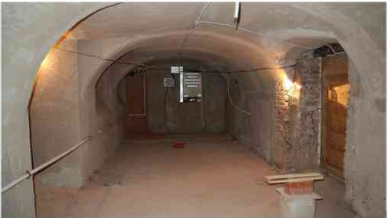
Фото п.4. Подвал, помещение 1Н (1-3).
