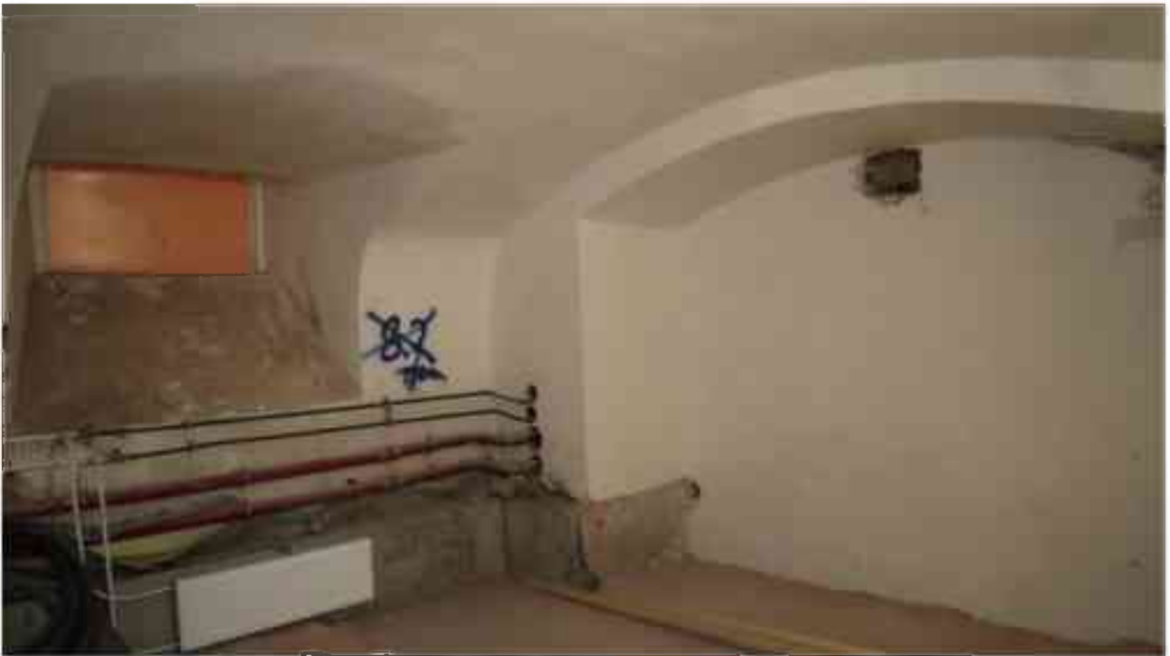
Фото п.160. Подвал, центральная часть помещения 9Н (13), разделенного перегородкой.
