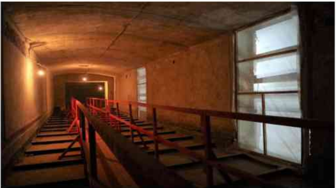
Фото 3.116. 3 этаж, помещение 25Н (2).
