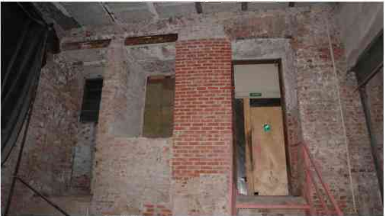
Фото п.49. Подвал, помещение ЗН (14).
