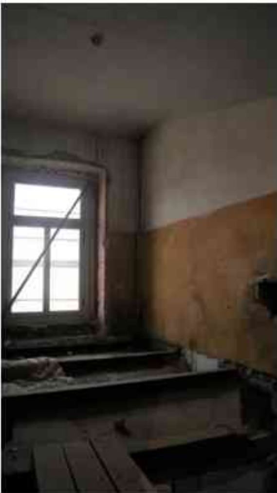
Фото 3.107. 3 этаж, помещение 28Н (5).
