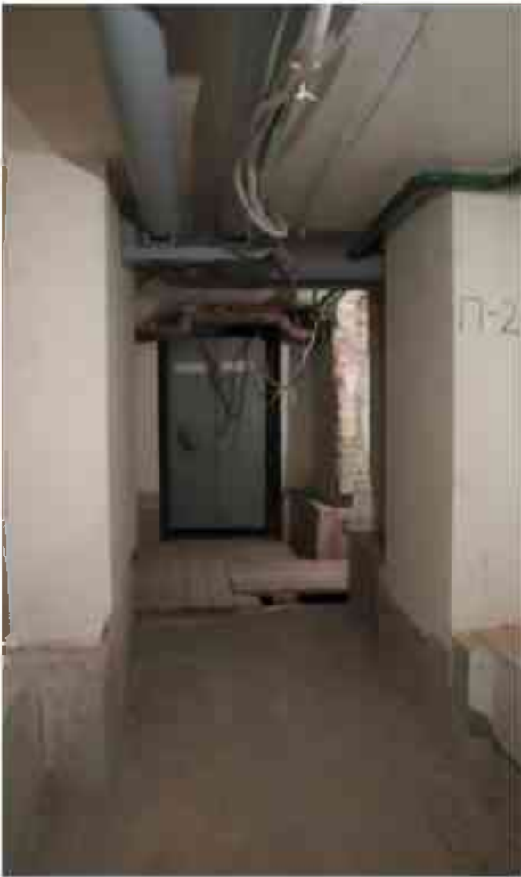
Фото п.148. Подвал, помещение 9Н (11-12).
