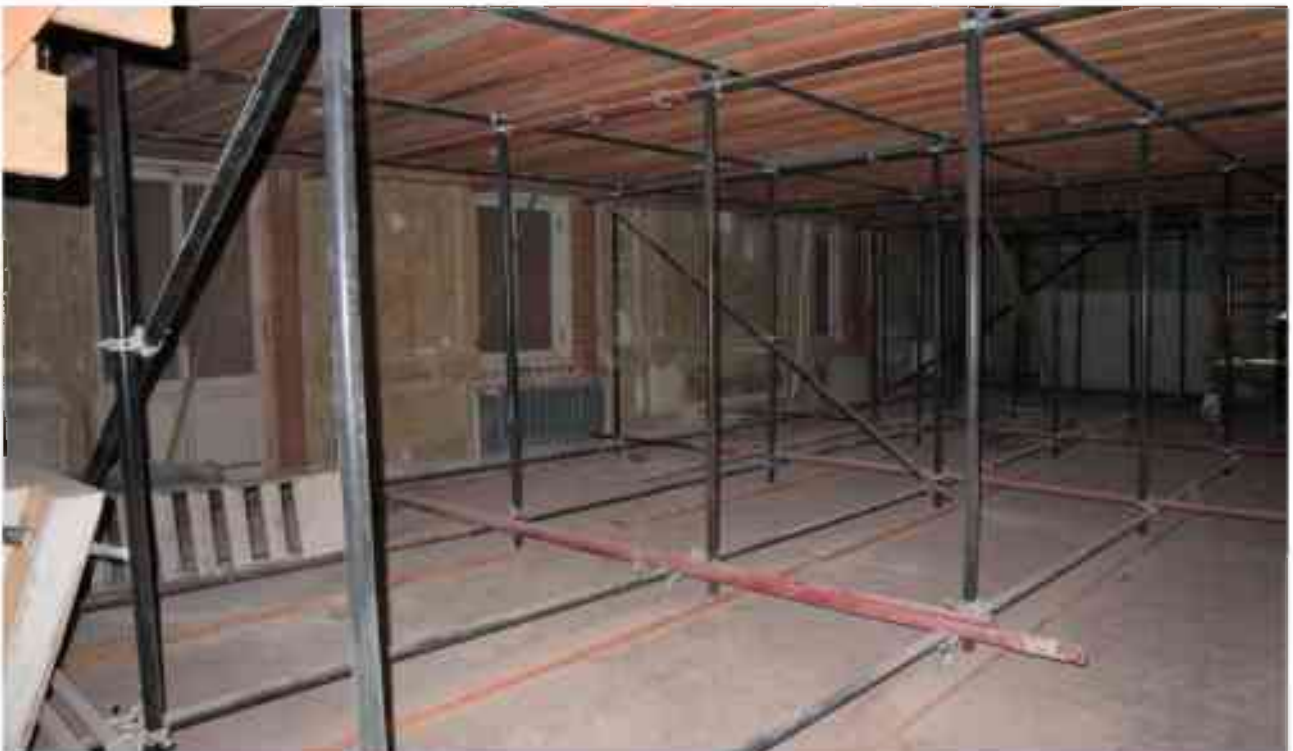
Фото 3.90. 3 этаж, помещение 28Н (12).
