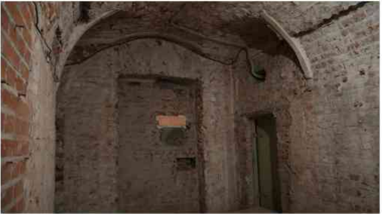
Фото 4.105. 4 этаж, помещение 42Н* (2).
