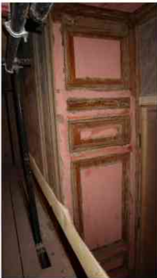
Фото 2.71. 2 этаж, помещение 22Н (31).*
