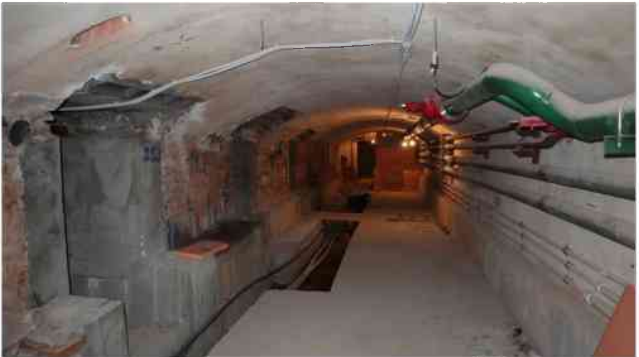
Фото п.192. Подвал, помещение 9Н (21).
