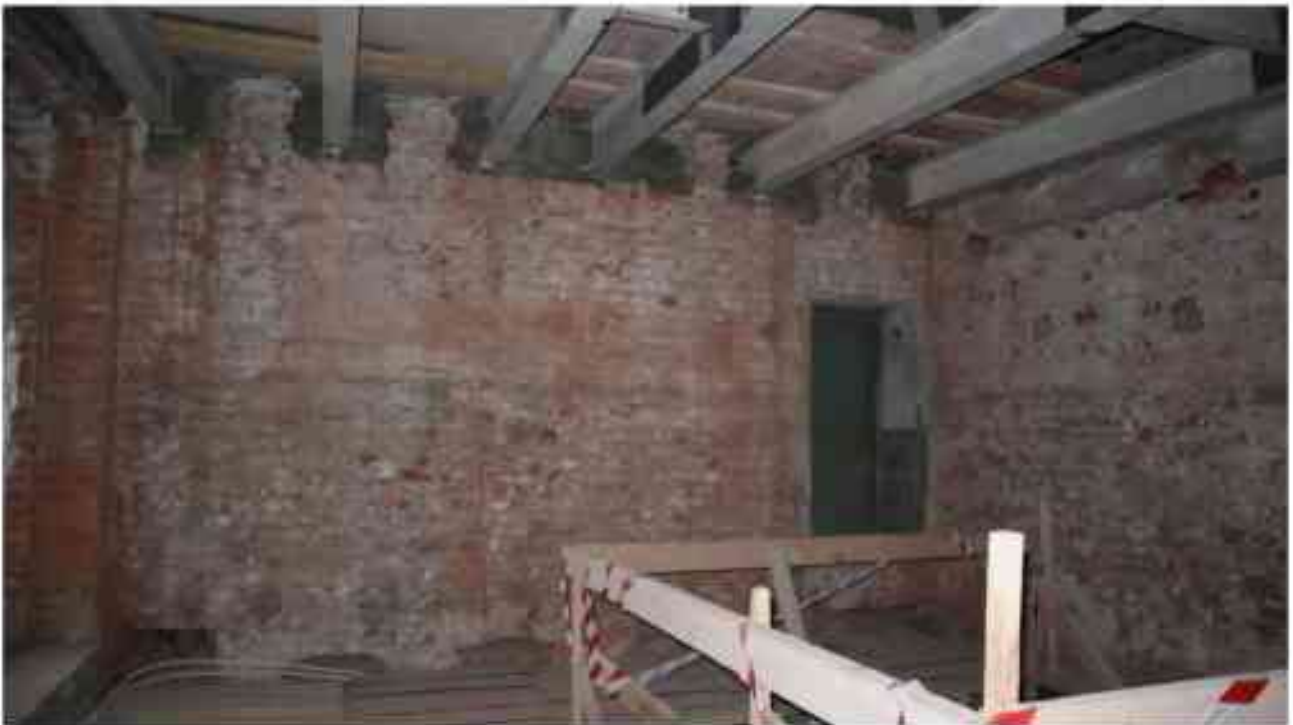
Фото 3.129. 3 этаж, помещение 25Н (6-7).
