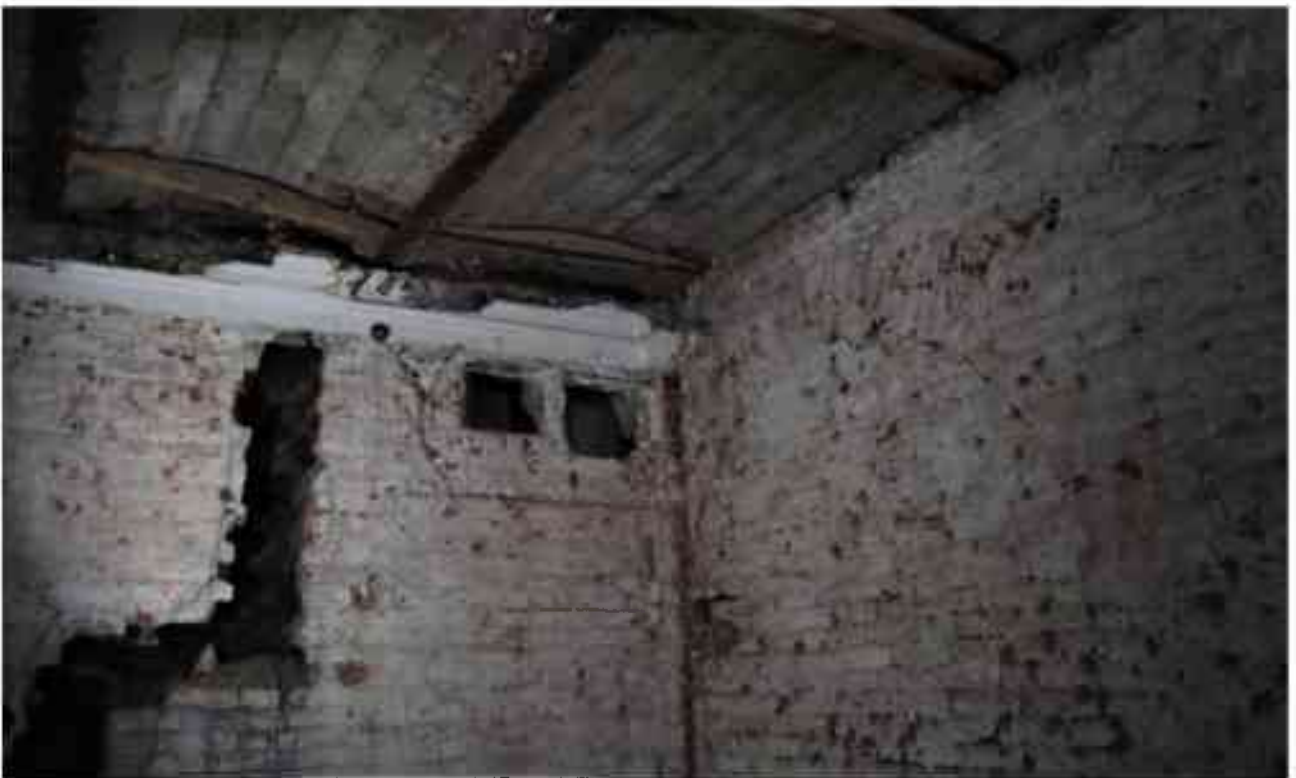
Фото 4.25. 4 этаж, помещение 33Н (33).
