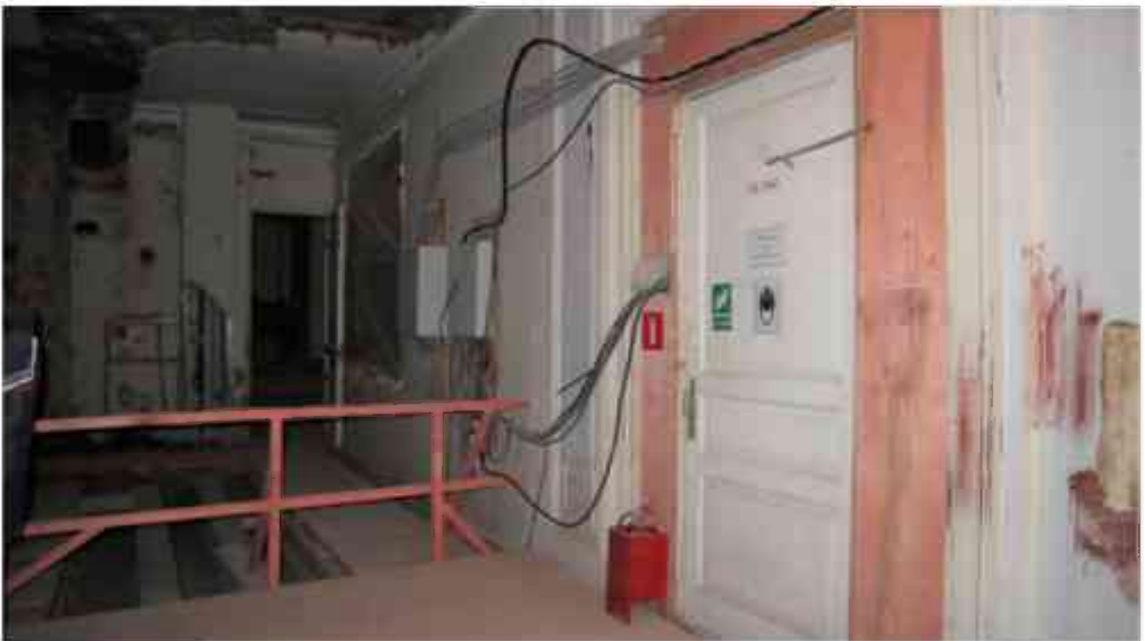
Фото 3.66. 3 этаж, помещение 28Н (5-10).
