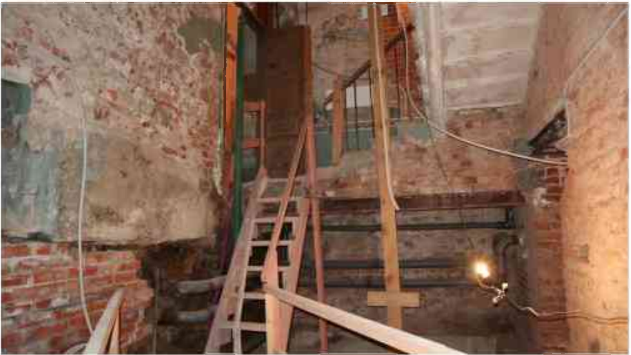
Фото п.66. Подвал, лестница Л-3.
