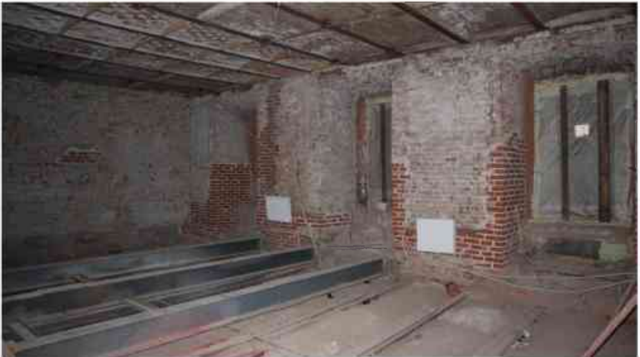
Фото 4.189. 4 этаж, помещение 42Н* (8-9).
