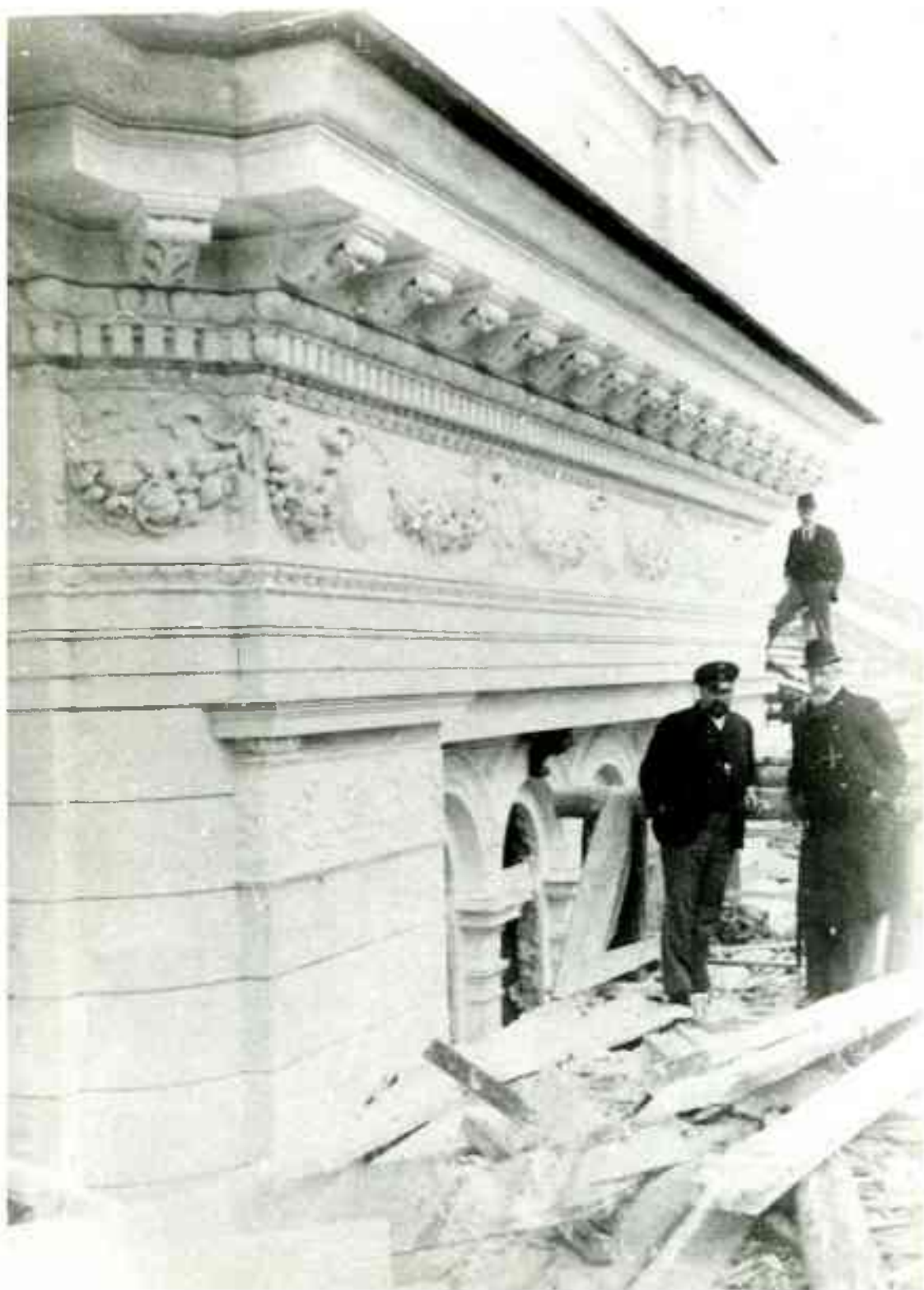
Ил. 112. Перестройка здания Большого театра под Консерваторию. Фото. 1891-1893 гг. РГИА. Ф.1293. Оп.167. Д.142. Л. 43. (Фото 85).
