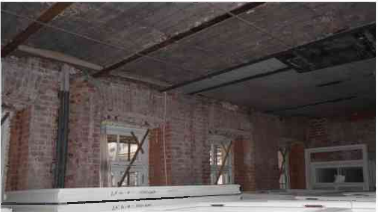
Фото 1.89. 1 этаж, помещение 14Н (36-42).
