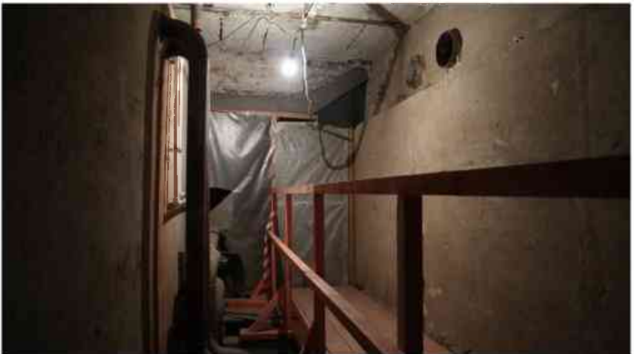
Фото п.74. Подвал, помещение 3Н (2).
