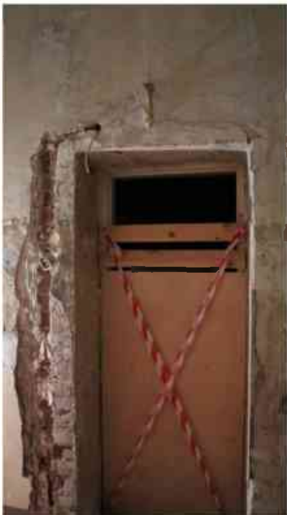
Фото 2.192. 2 этаж, помещение 22Н (7).
