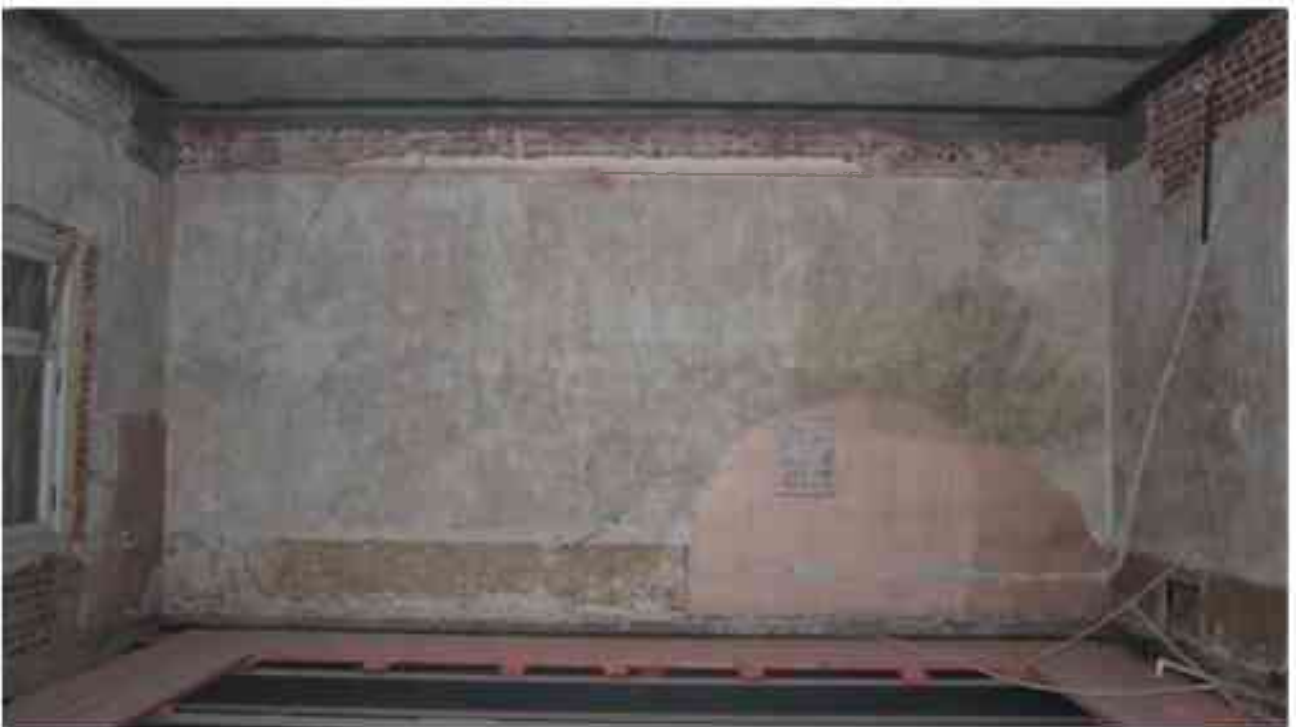
Фото 4.37. 4 этаж, помещение 33Н (40, 41).
