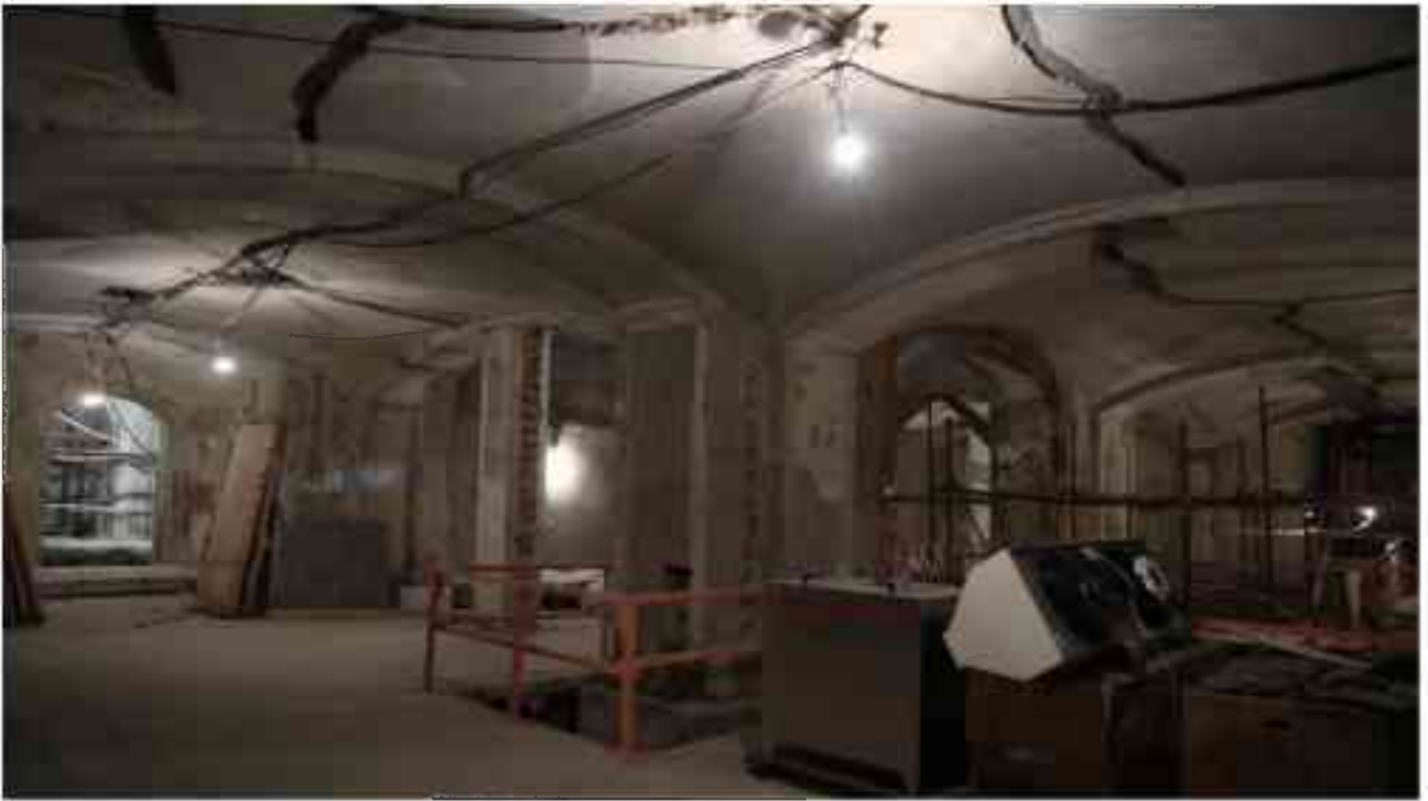
Фото 1.310. 1 этаж, помещение 13Н (4).
