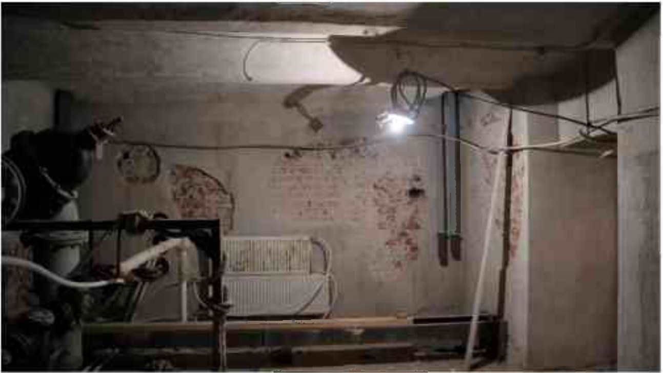
Фото п.11. Подвал, помещение 2Н (2).
