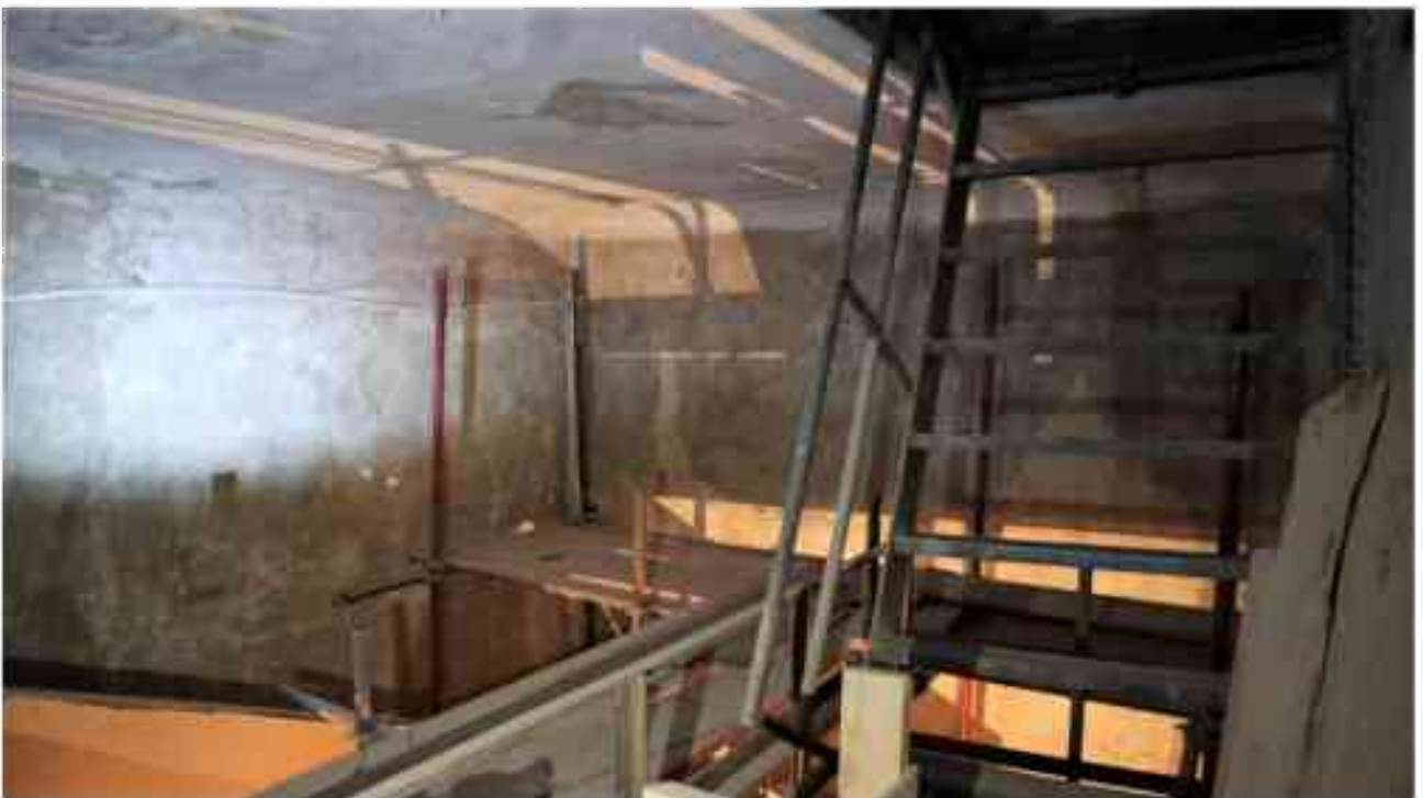
Фото 5.45. 5 этаж, лестница Л-7.
