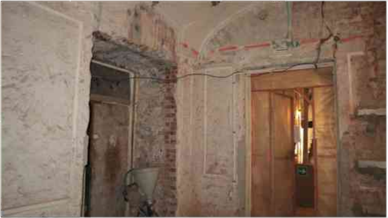
Фото 2.35. 2 этаж, помещение 22Н (64).
