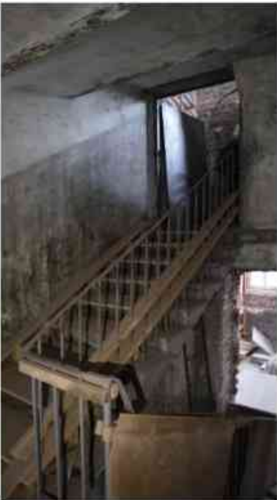
Фото 6.53. 6 этаж, лестница Л-17.
