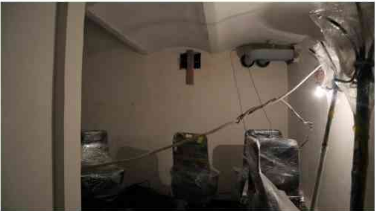
Фото п.138. Подвал, помещение 9Н (26).
