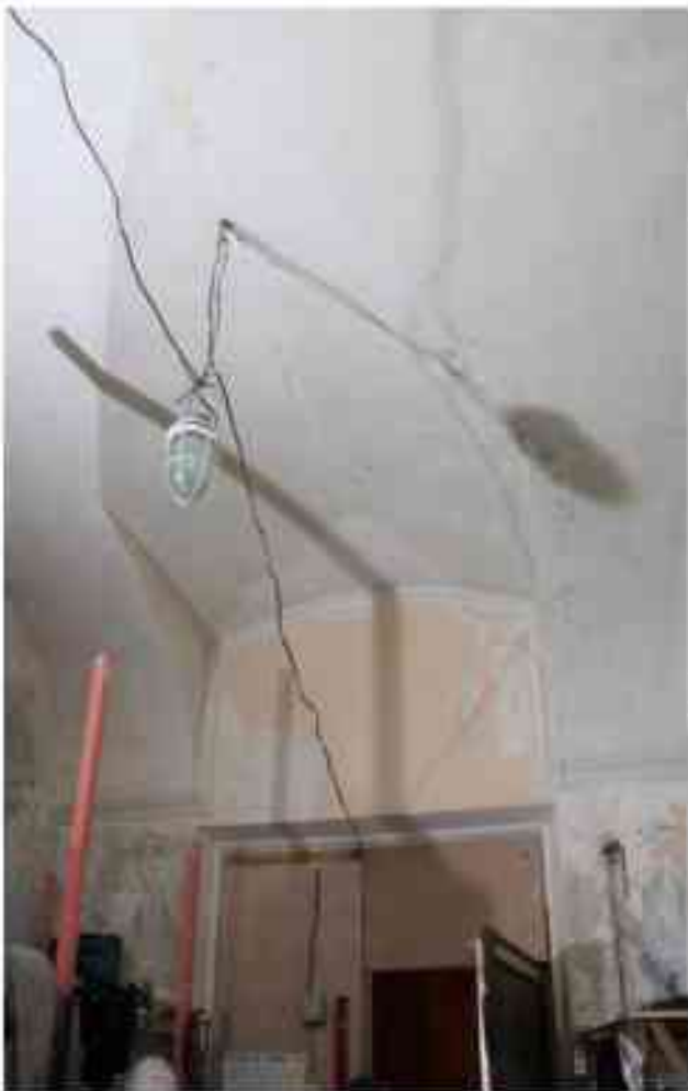
Фото 2.118. 2 этаж, помещение 22Н (56).
