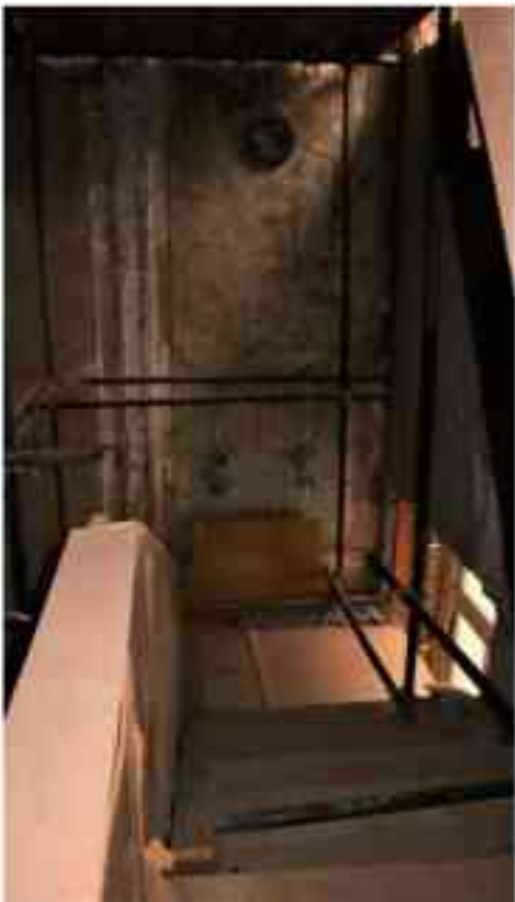
Фото 5.60. 5 этаж, лестница с перекрестными маршами, трехмаршевая, в центре здания.*
