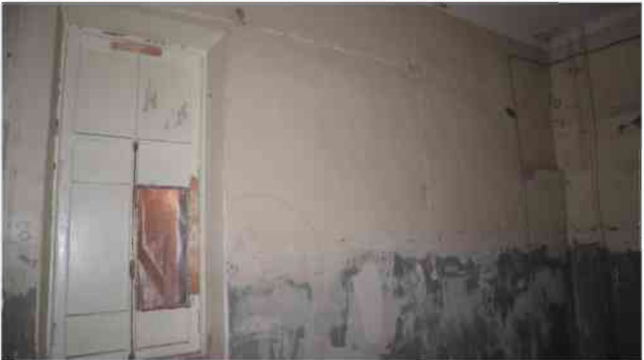
Фото 2.62. 2 этаж, помещение 22Н (26).
