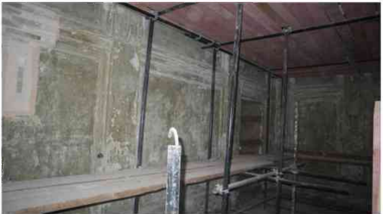
Фото 3.147. 3 этаж, помещение 25Н (11).
