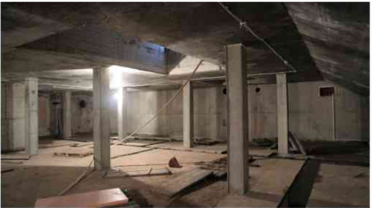
Фото п.239. Подвал, восточного двора.*
