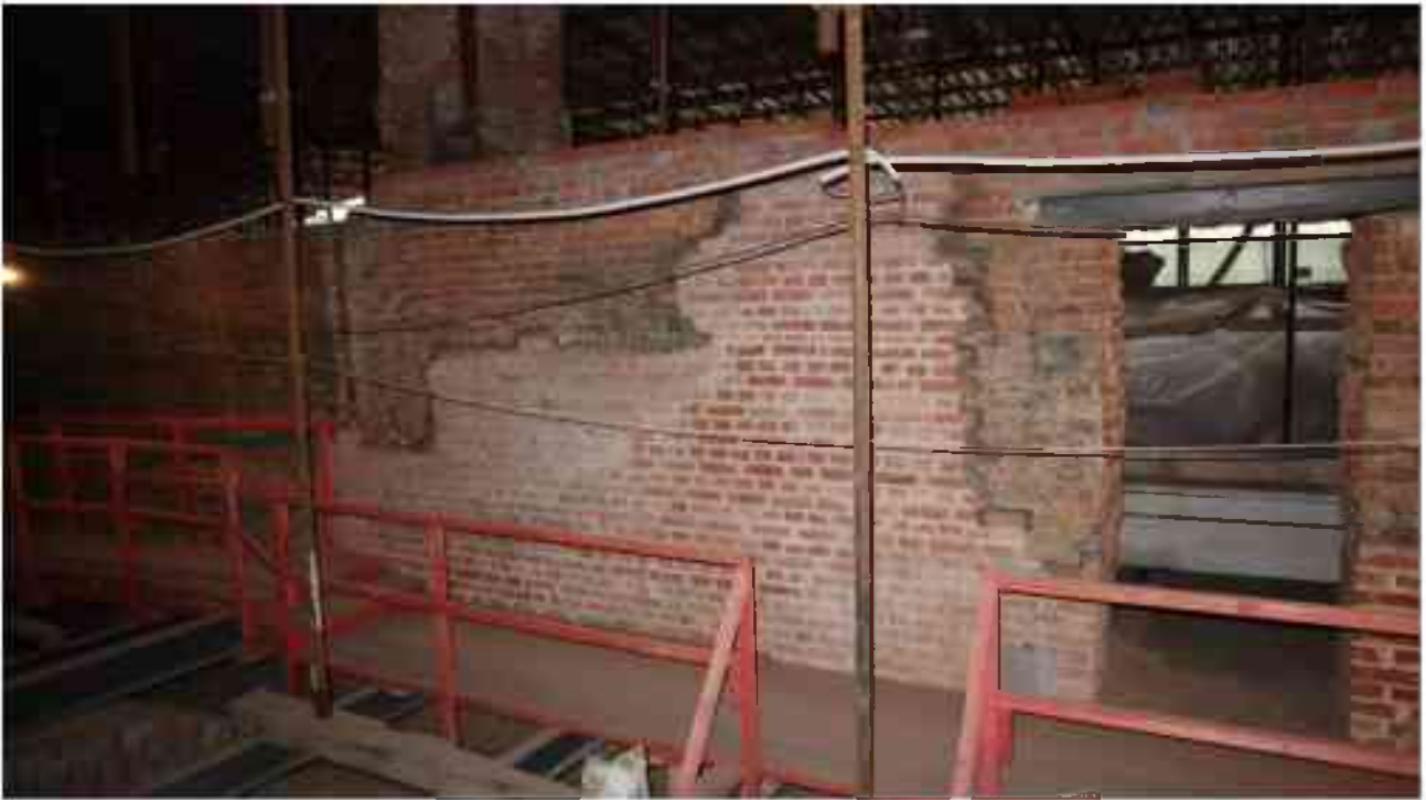
Фото 5.186. 5 этаж, коридор, помещения 34Н/37Н.
