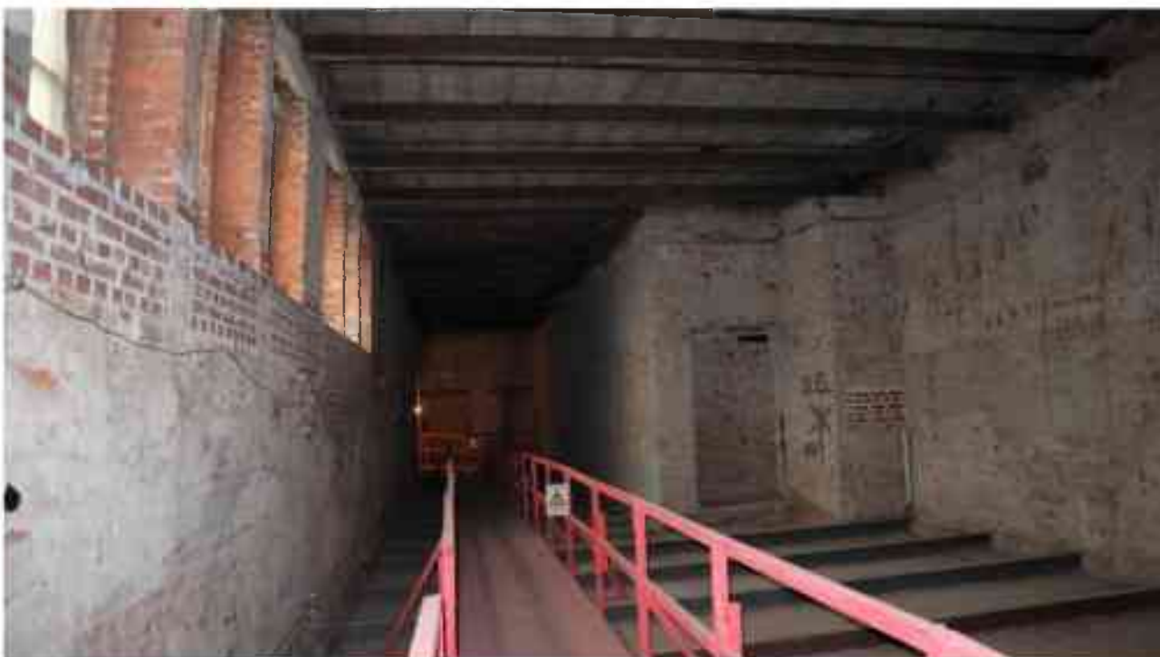
Фото 5.71. 5 этаж, помещение 35Н (4-6).
