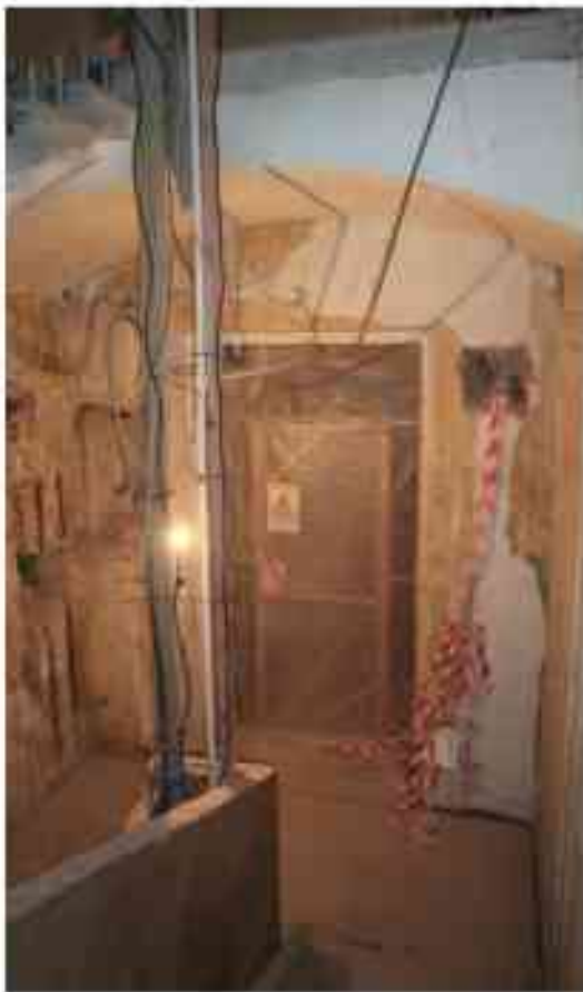
Фото 4.80. 4 этаж, лестница Л-1.
