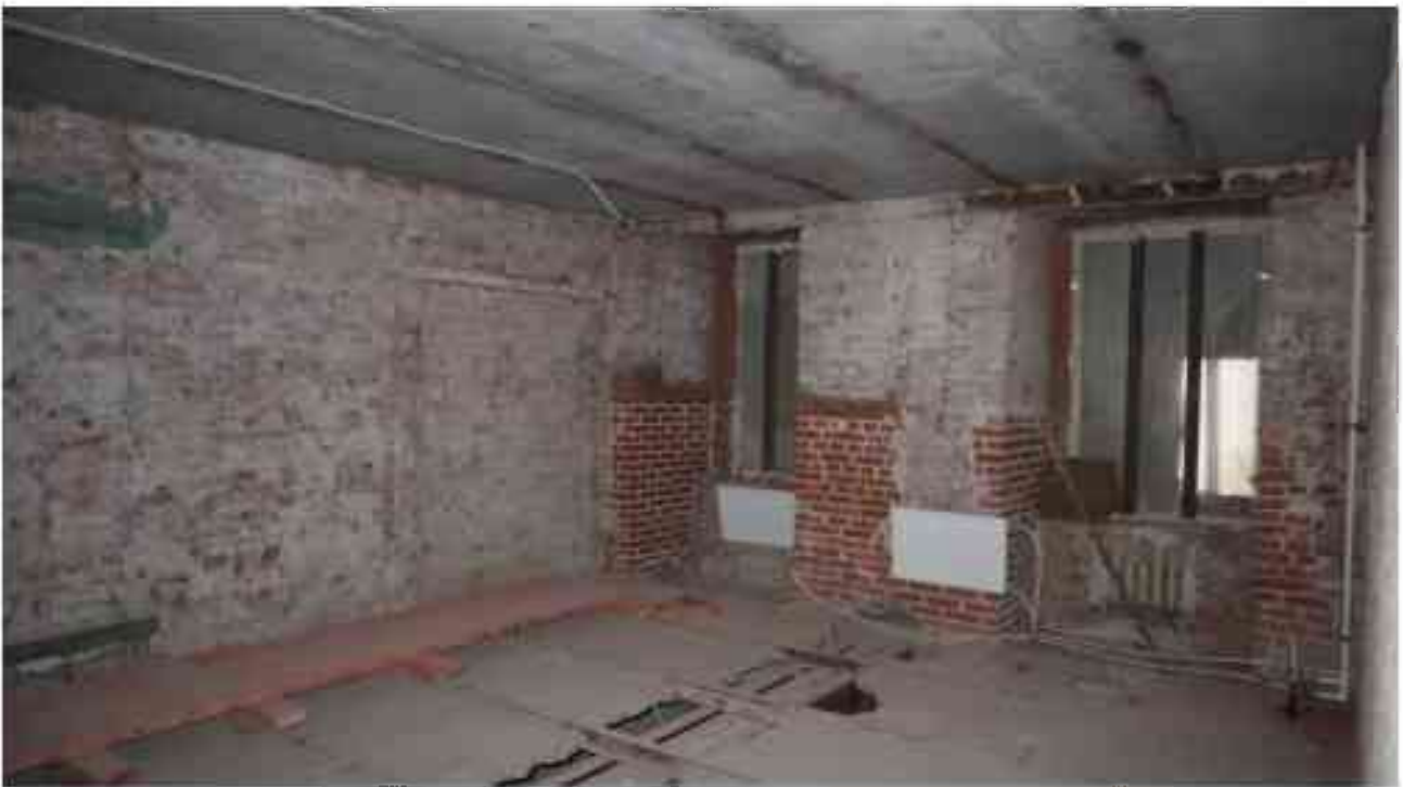
Фото 4.195. 4 этаж, помещение 42Н* (5-7).
