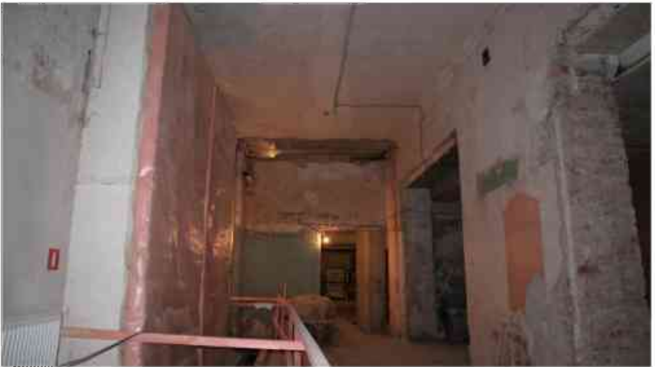
Фото 1.313. 1 этаж, помещение 15Н (1).
