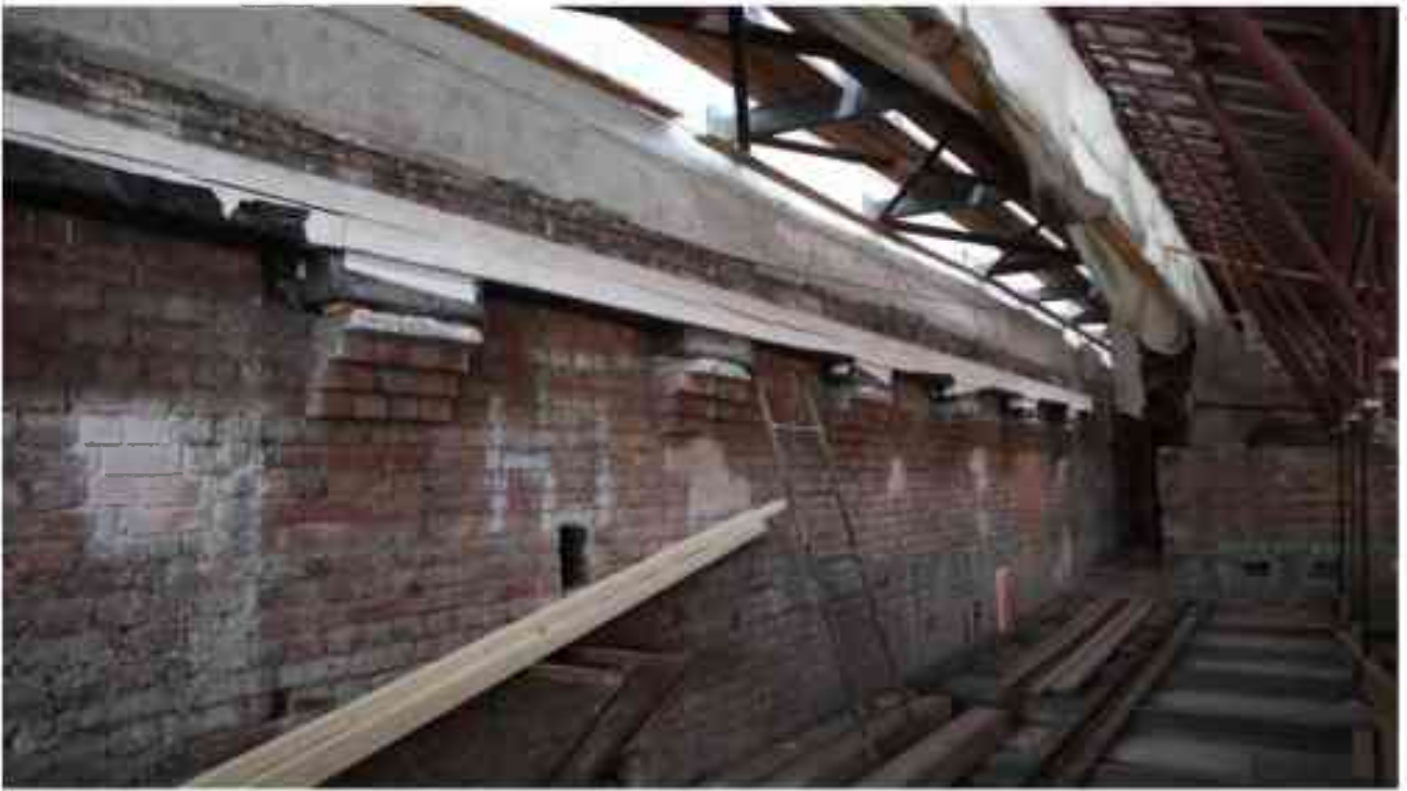
Фото 6.50. 6 этаж, чердачное помещение.
