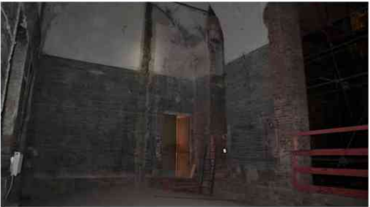
Фото 2.215. 2 этаж, помещение 22Н (83).
