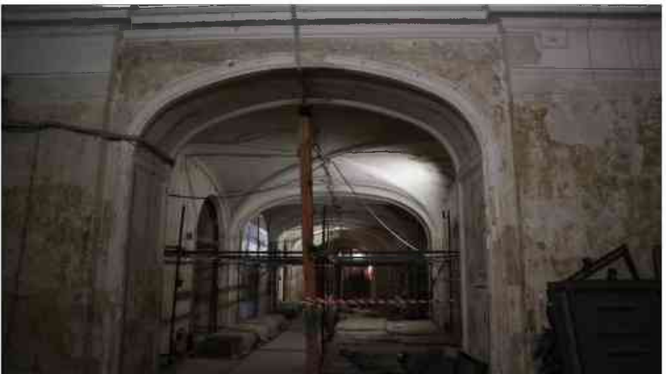
Фото 1.245. 1 этаж, помещение 13Н (5-6).
