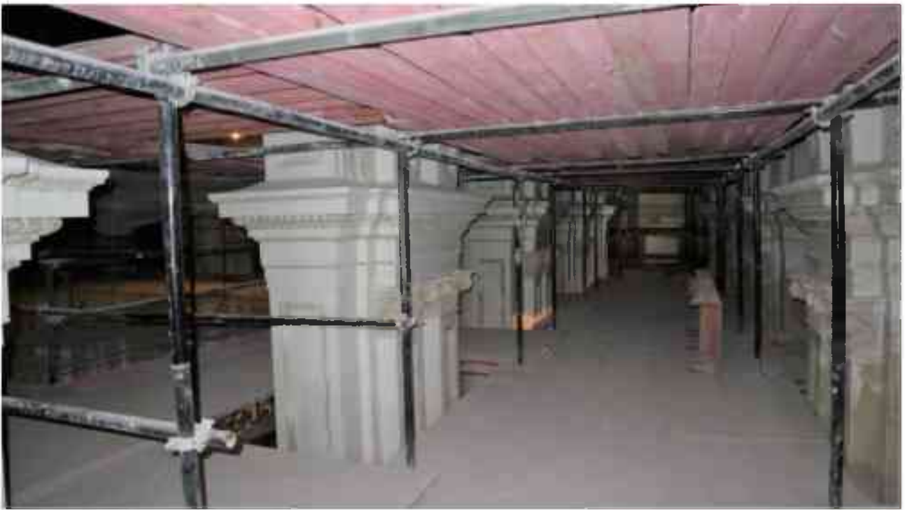
Фото 2.143. 2 этаж, помещение 22Н (19).*
