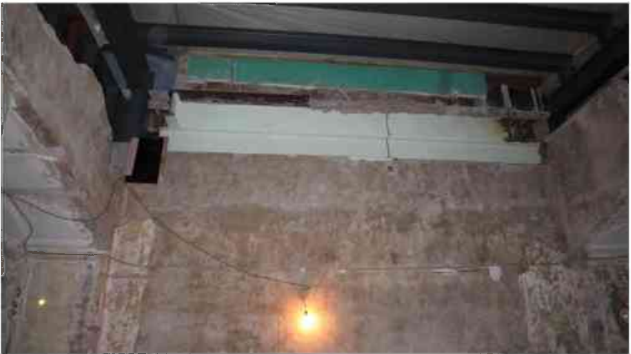
Фото 1.297. 1 этаж, помещение 13Н (35).
