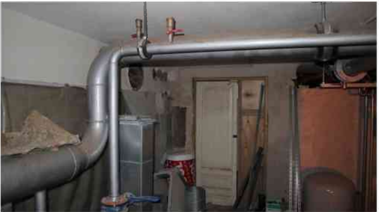
Фото п.309. Подвал, помещение 3Н (16).
