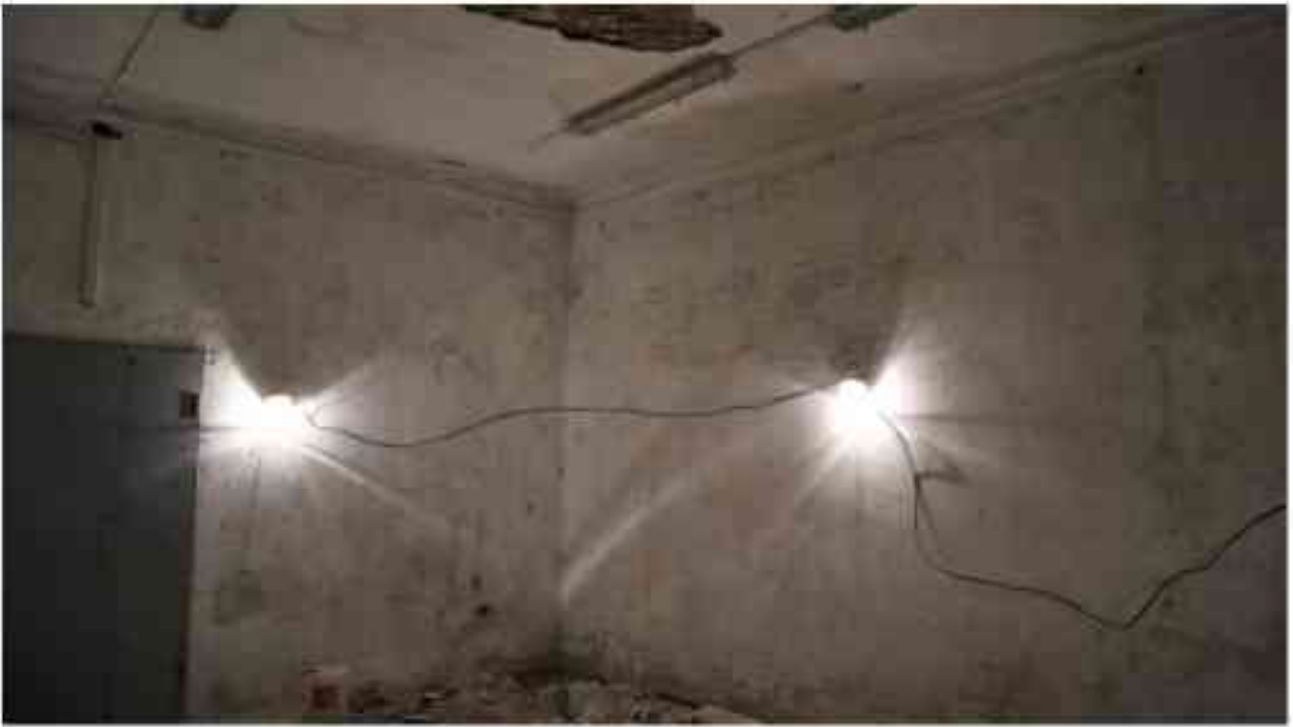
Фото 3.172. 3 этаж, помещение 24Н (1).
