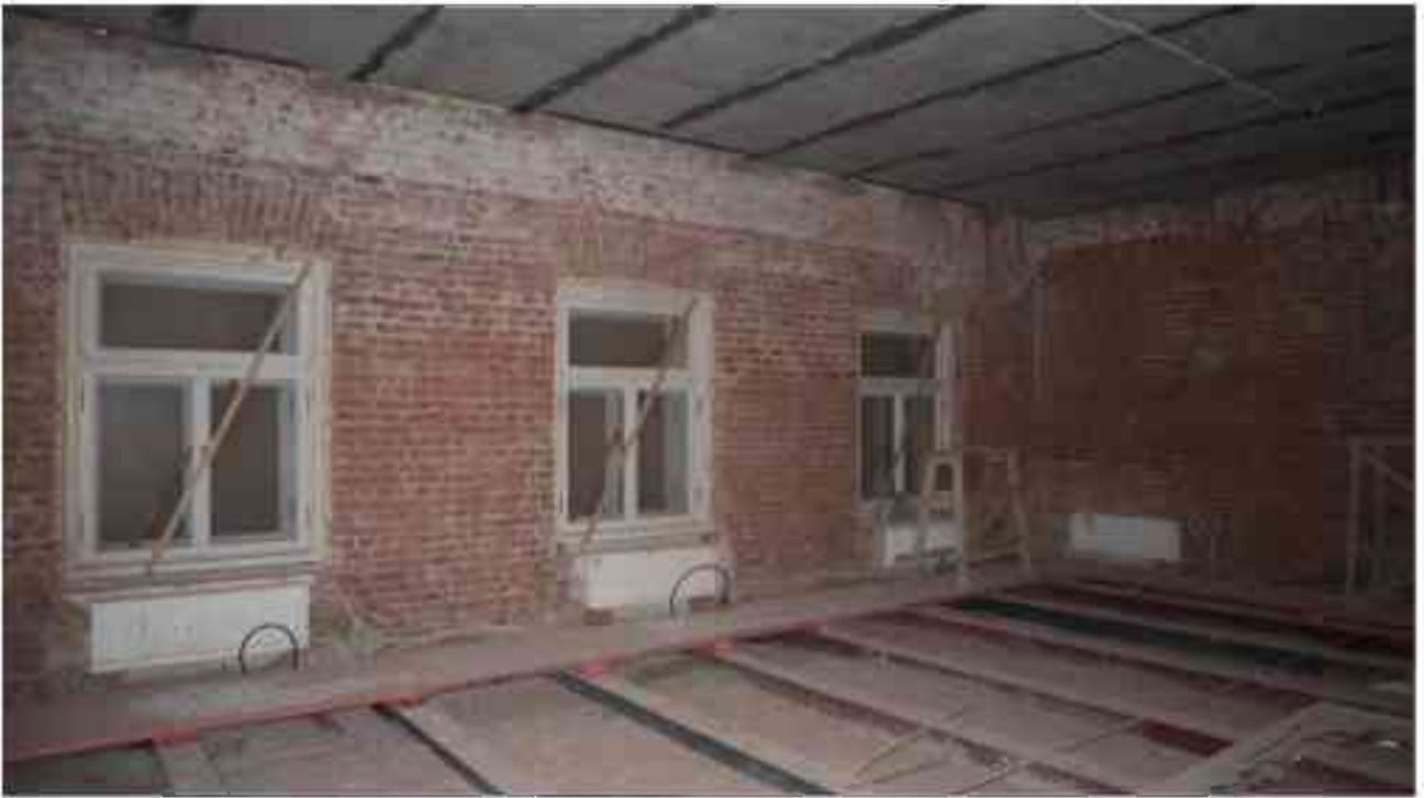
Фото 4.67. 4 этаж, помещение 33Н (51).
