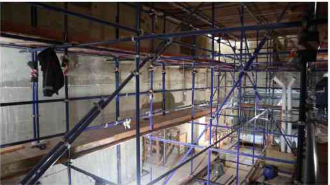
Фото 3.51. 3 этаж, помещение 28Н (20-21).*
