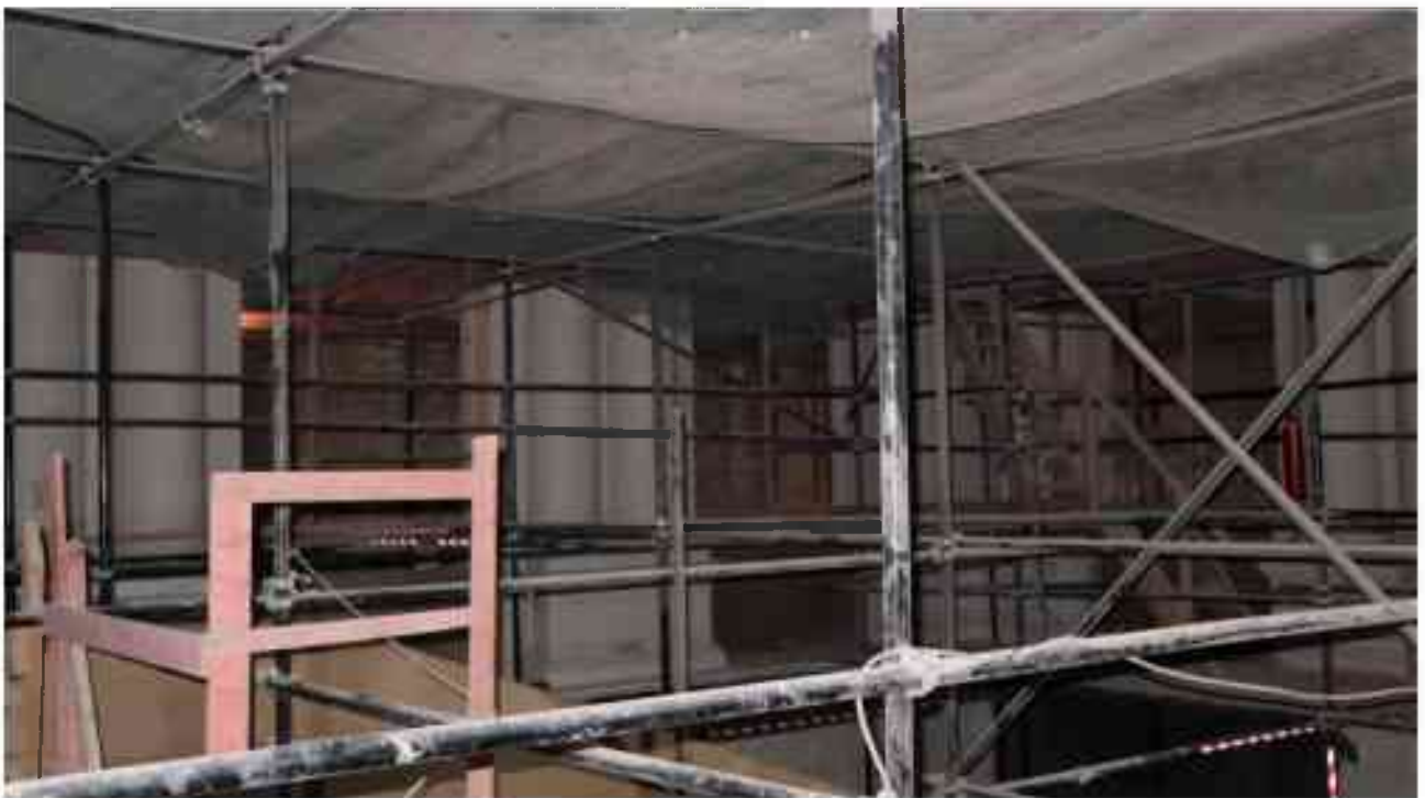
Фото 1.281. 1 этаж, лестница Л-11.
