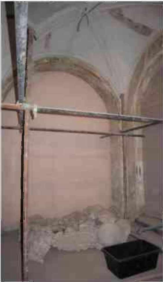
Фото 1.282. 1 этаж, помещение 13Н (34).
