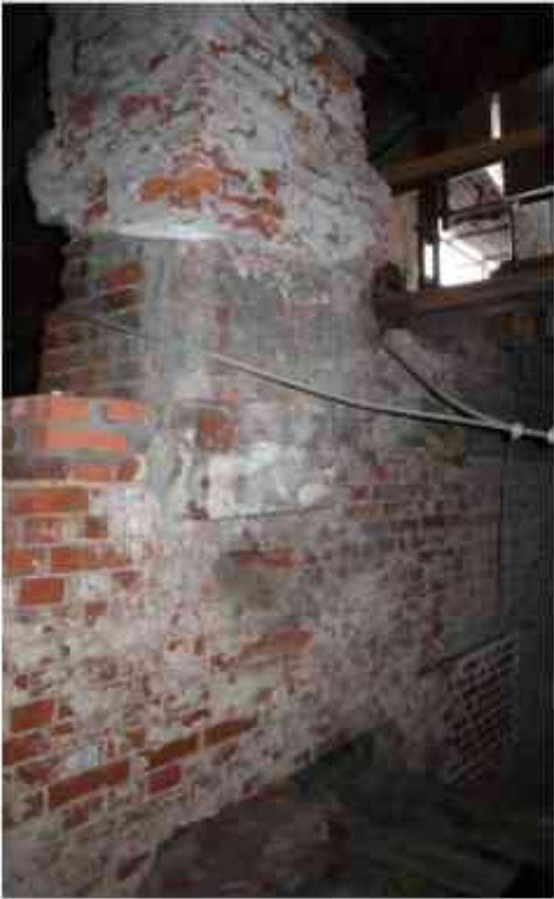
Фото 6.28. 6 этаж, чердачное помещение.
