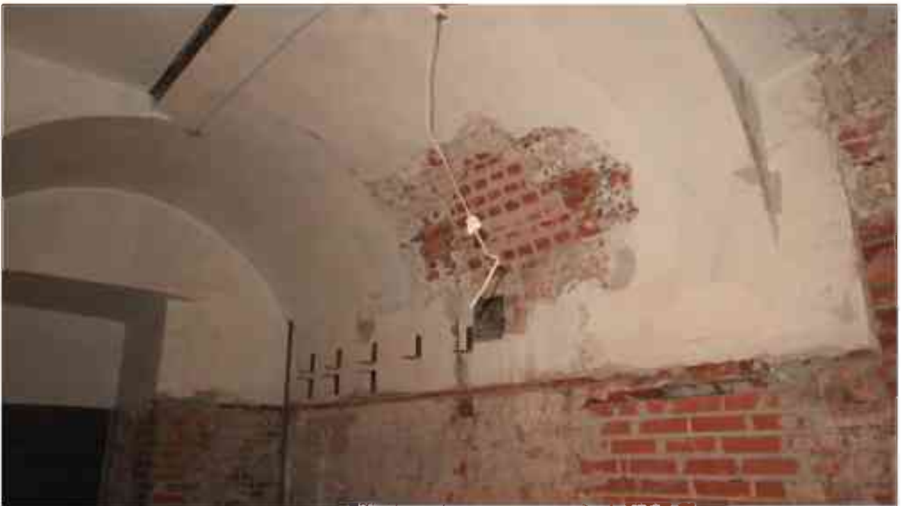
Фото 1.241. 1 этаж, помещение 17Н (5-6).
