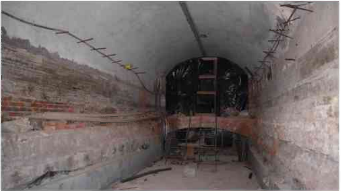
Фото п.318. Подвал, помещение 9Н (1).
