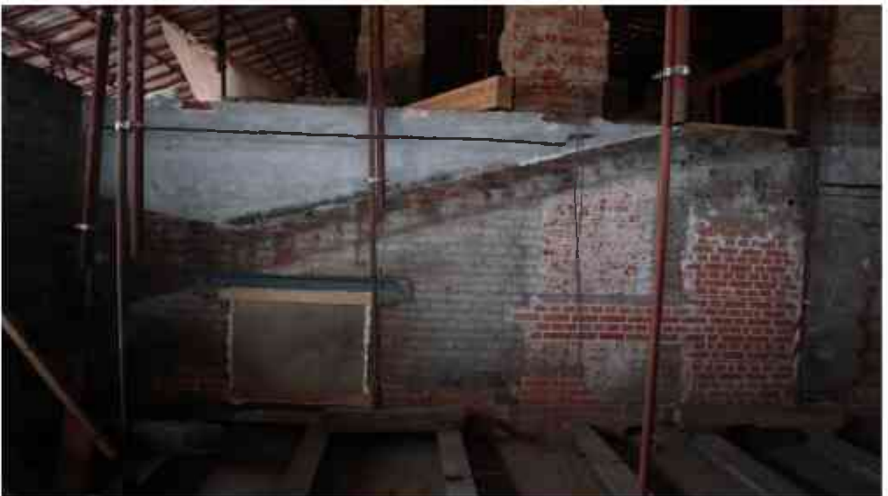
Фото 5.193. 5 этаж, чердачное помещение.
