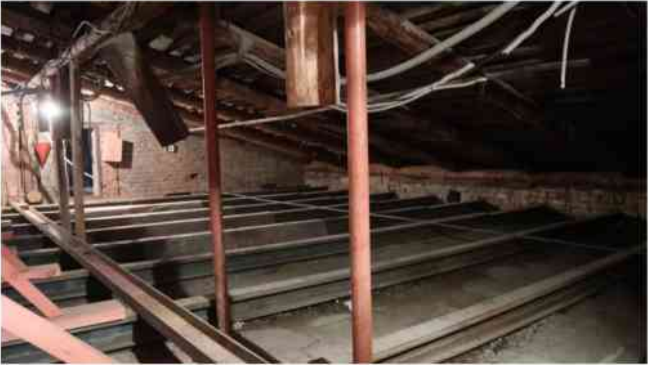
Фото 6.10. 6 этаж, чердачное помещение.
