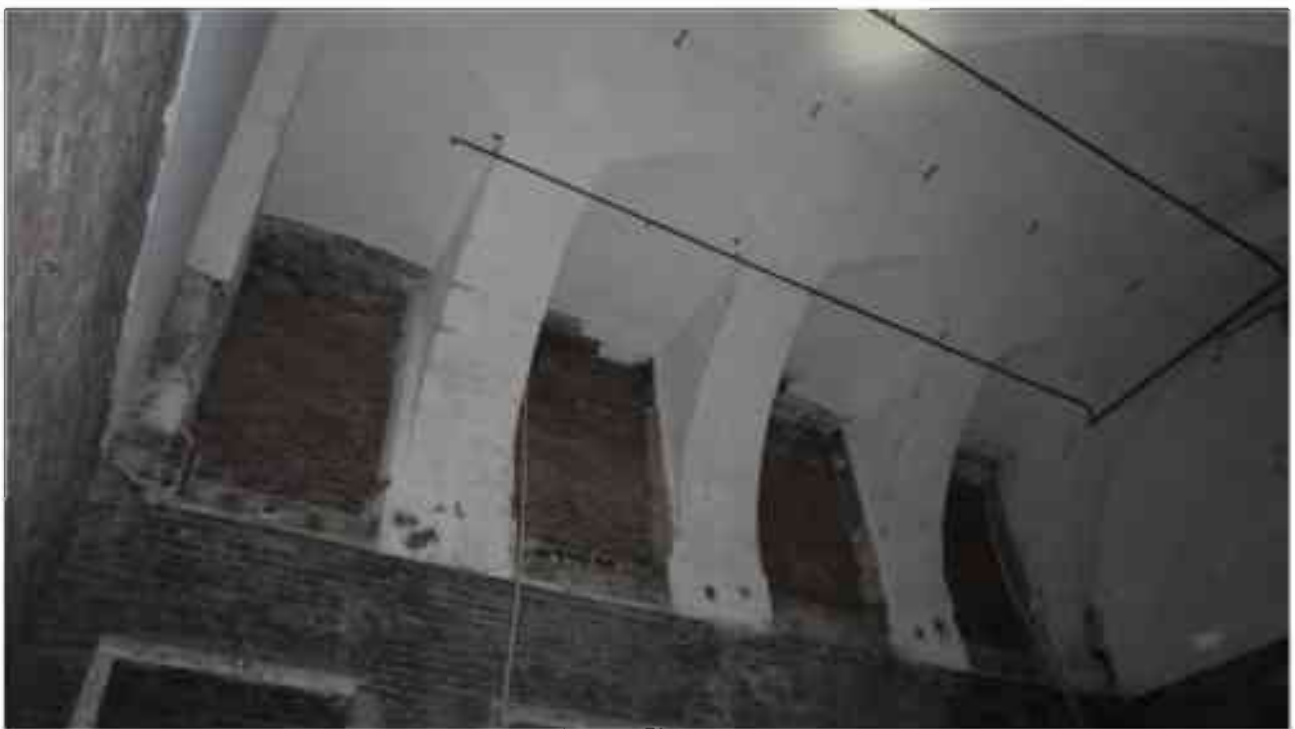
Фото 2.218. 2 этаж, помещение 22Н (83).
