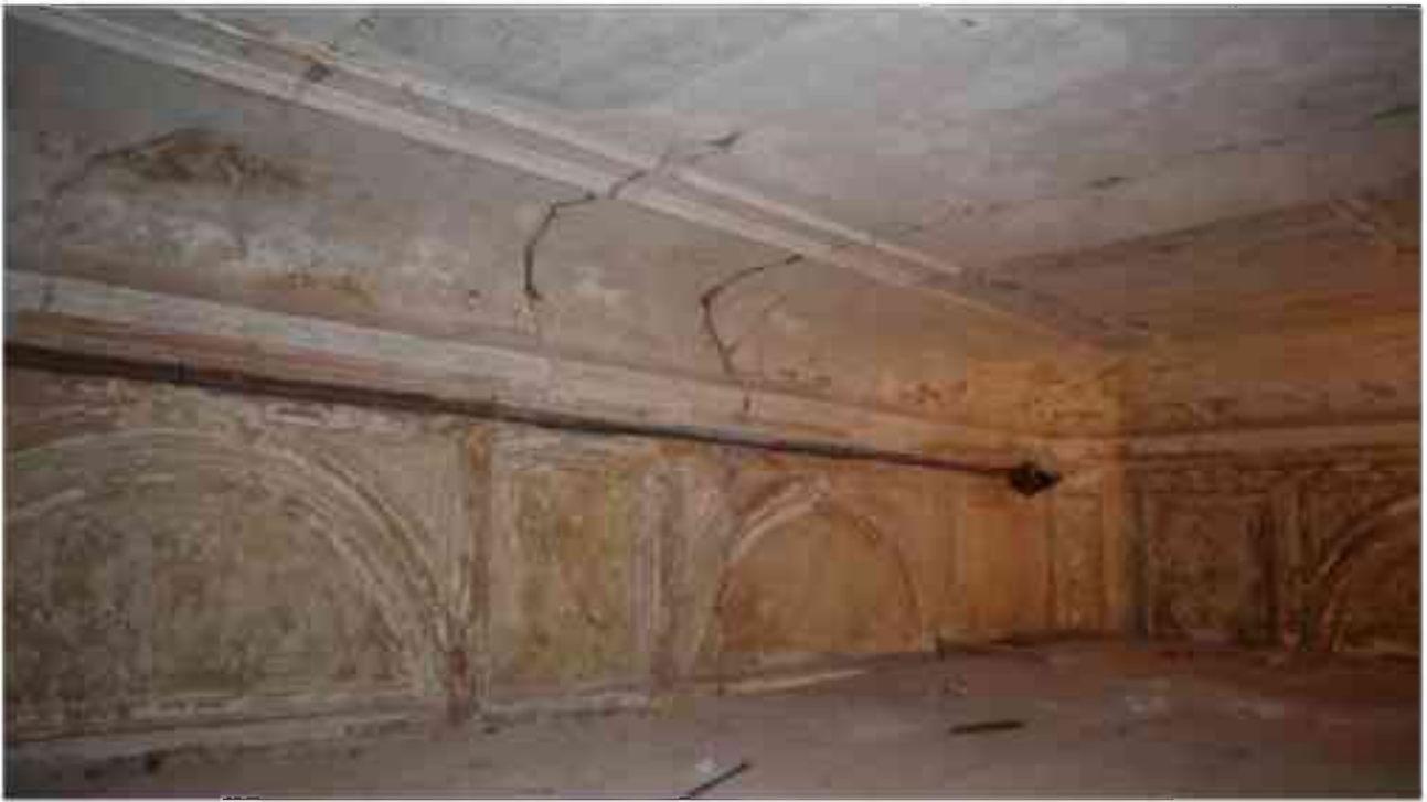
Фото 2.135. 2 этаж, помещение 22Н (18).*
