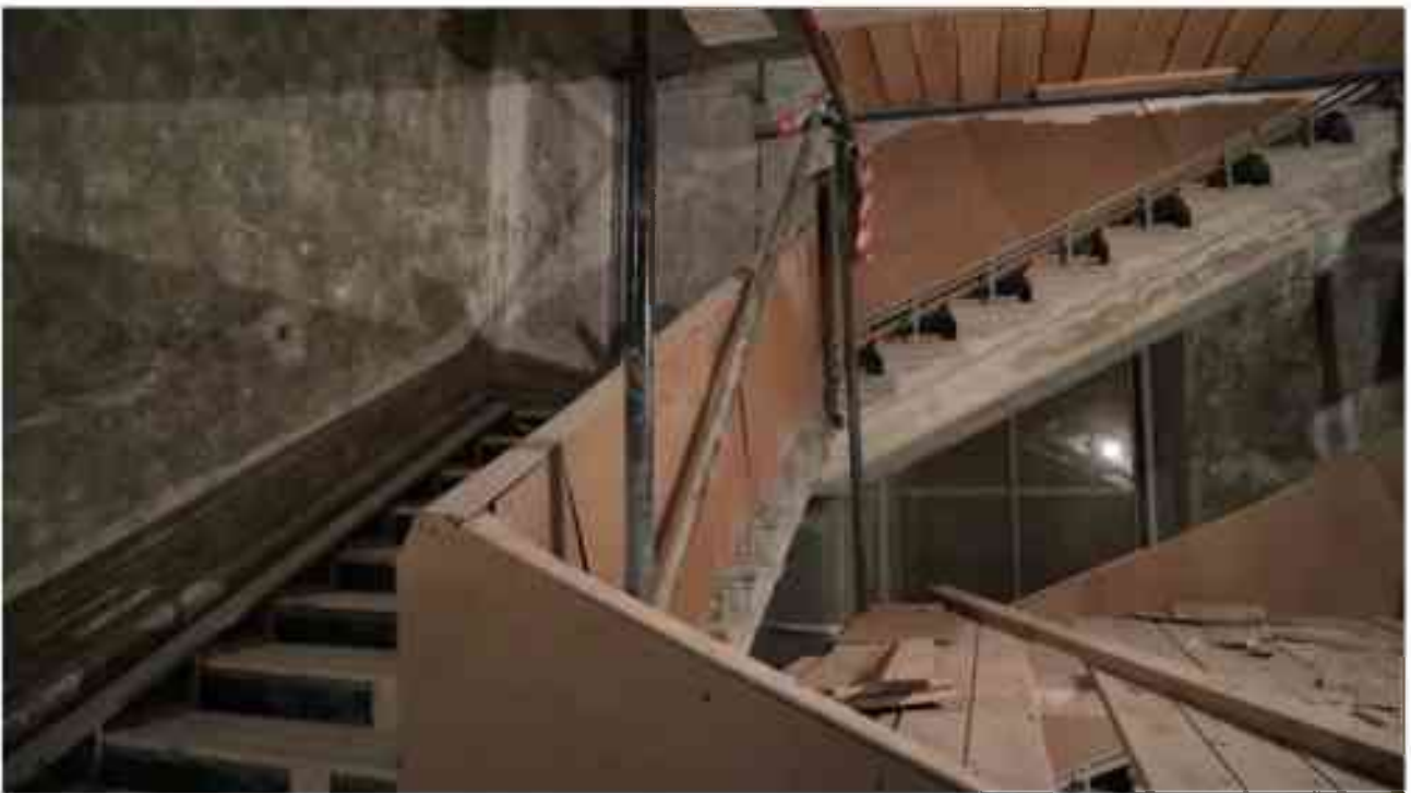
Фото 2.177. 2 этаж, лестница в ризалите южного фасада (западная часть).*
