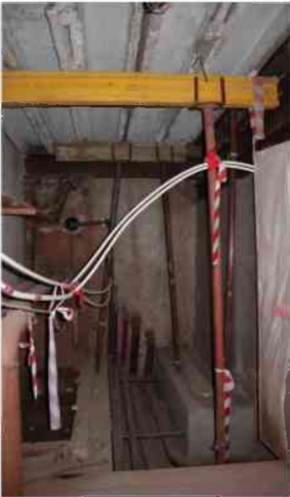
Фото п.24. Подвал, помещение 3Н (5).
