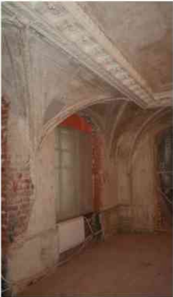
Фото 4.22. 4 этаж, помещение 33Н (32).
