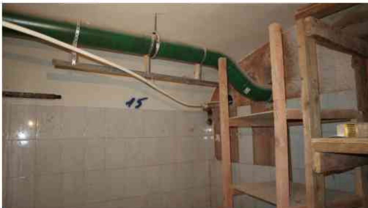
Фото п.267. Подвал, помещение 6Н (6).
