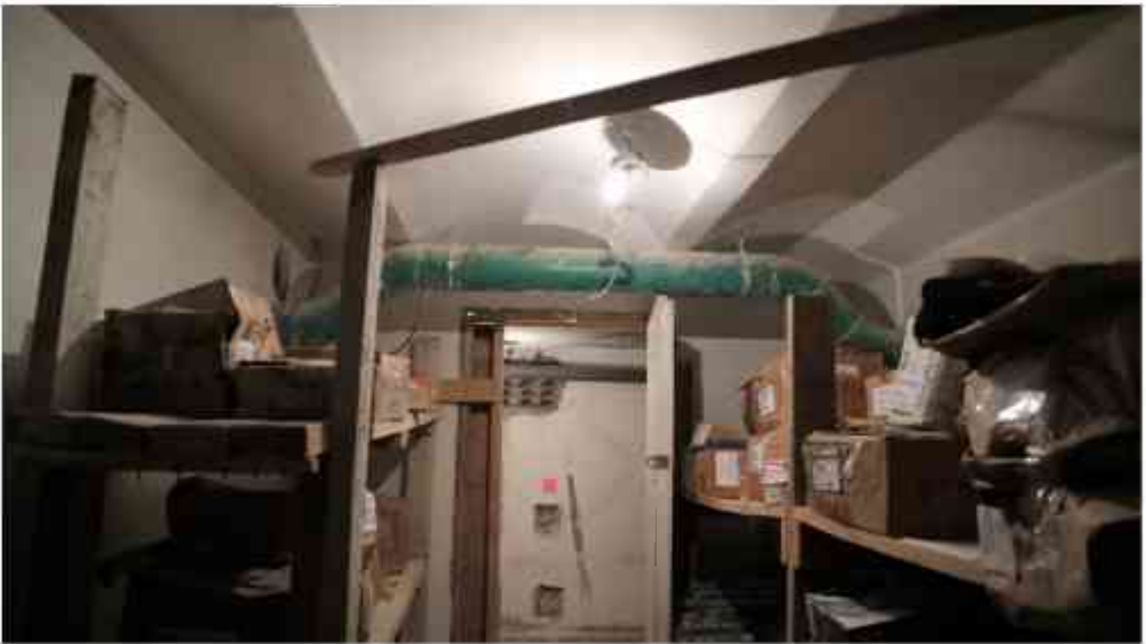
Фото п.128. Подвал, помещение 4Н (12).
