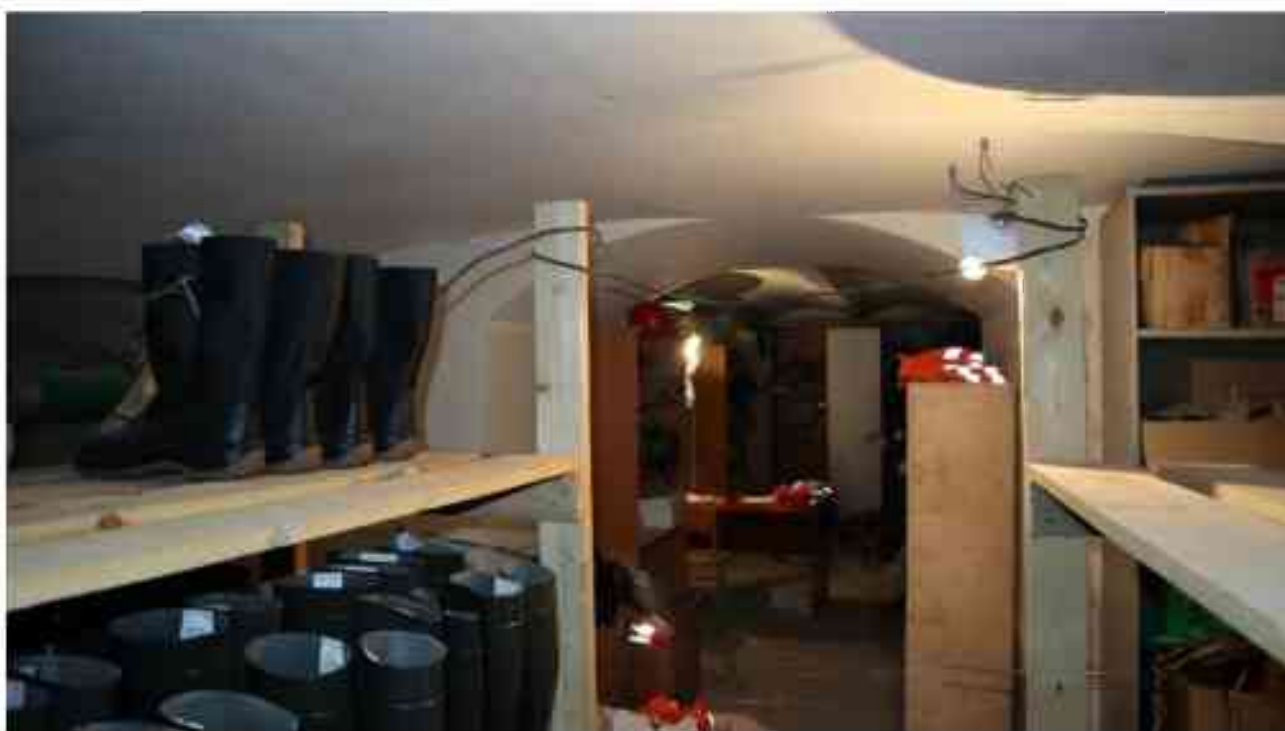
Фото п.126. Подвал, помещение 4Н (3-5).
