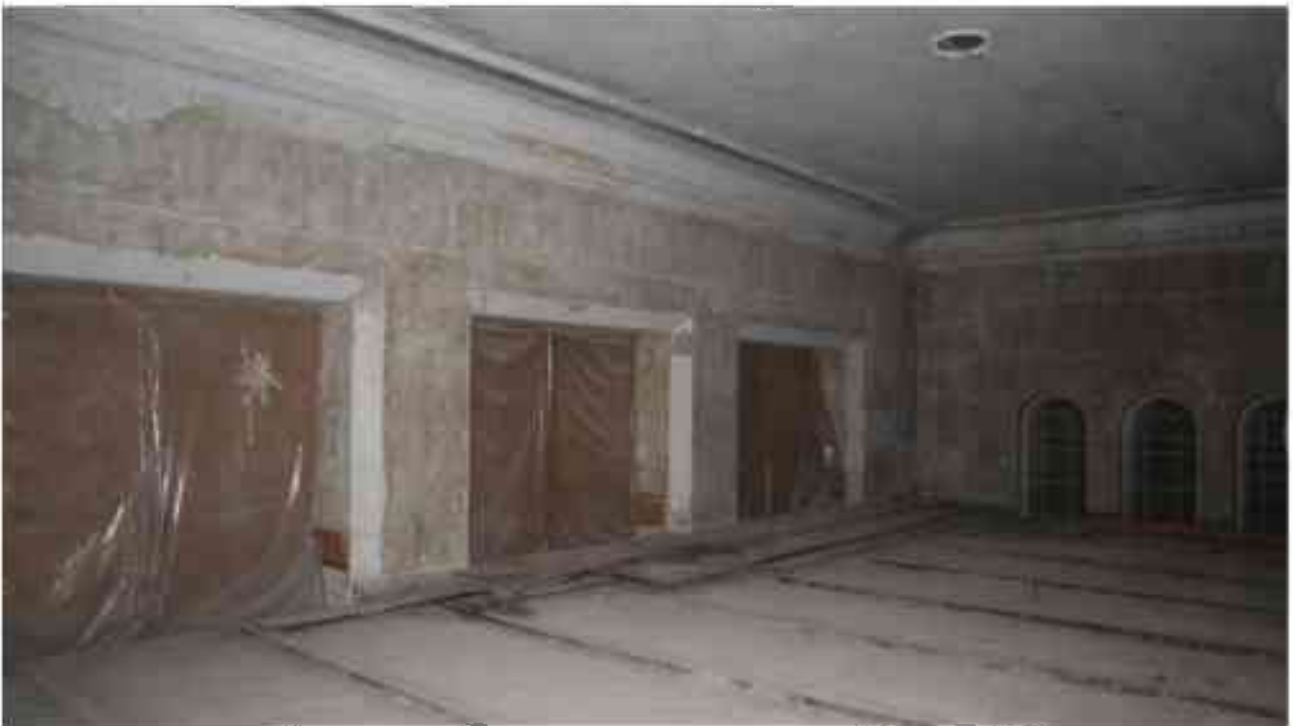
Фото 4.11. 4 этаж, помещение 33Н (38).
