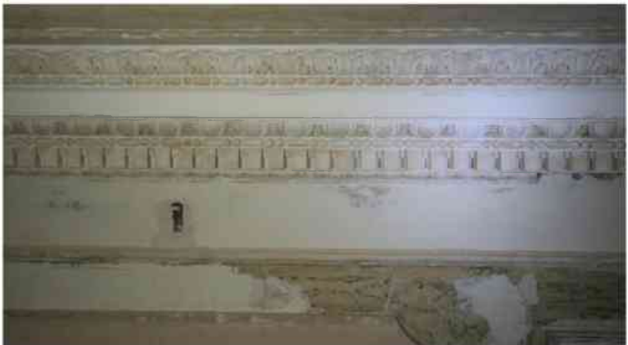
Фото 3.94. 3 этаж, помещение 28Н (12).*
