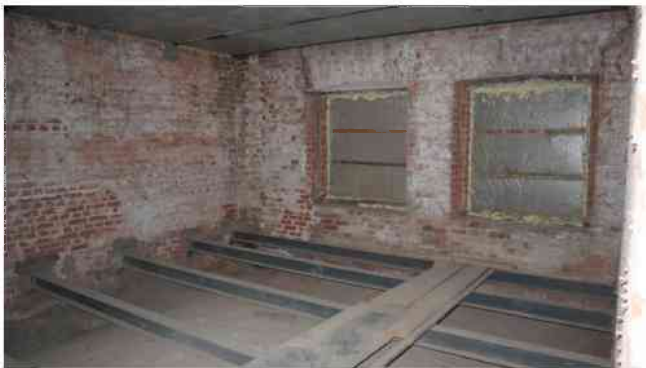
Фото 5.153. 5 этаж, жилой блок, на плане ПИБ 2000г. обозначен как квартиры, помещение (1-2).
