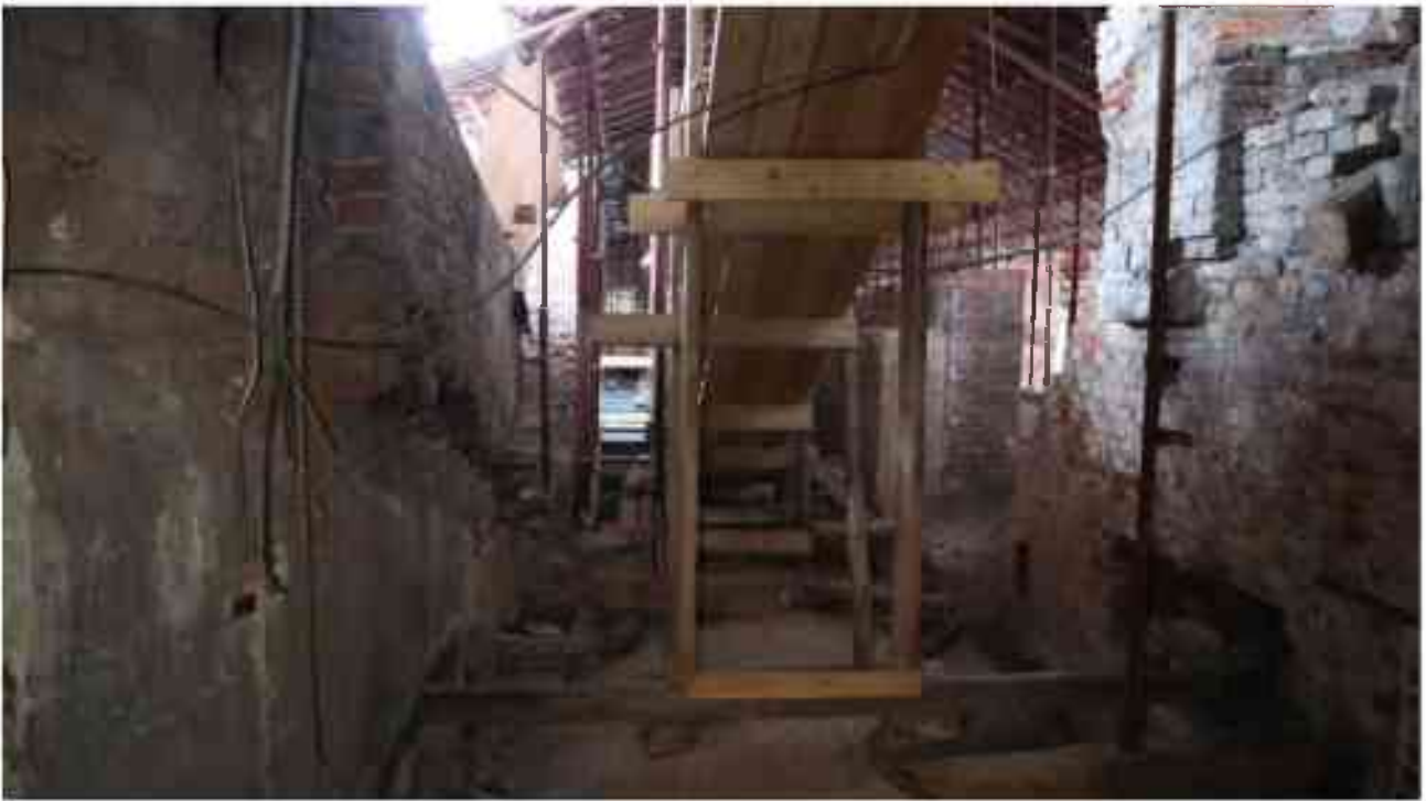
Фото 6.26. 6 этаж, чердачное помещение.
