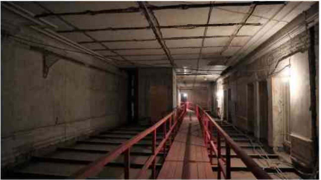
Фото 4.138. 4 этаж, помещение 30Н (1).
