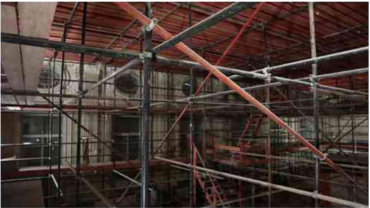
Фото 3.78. 3 этаж, помещение 28Н (2).*
