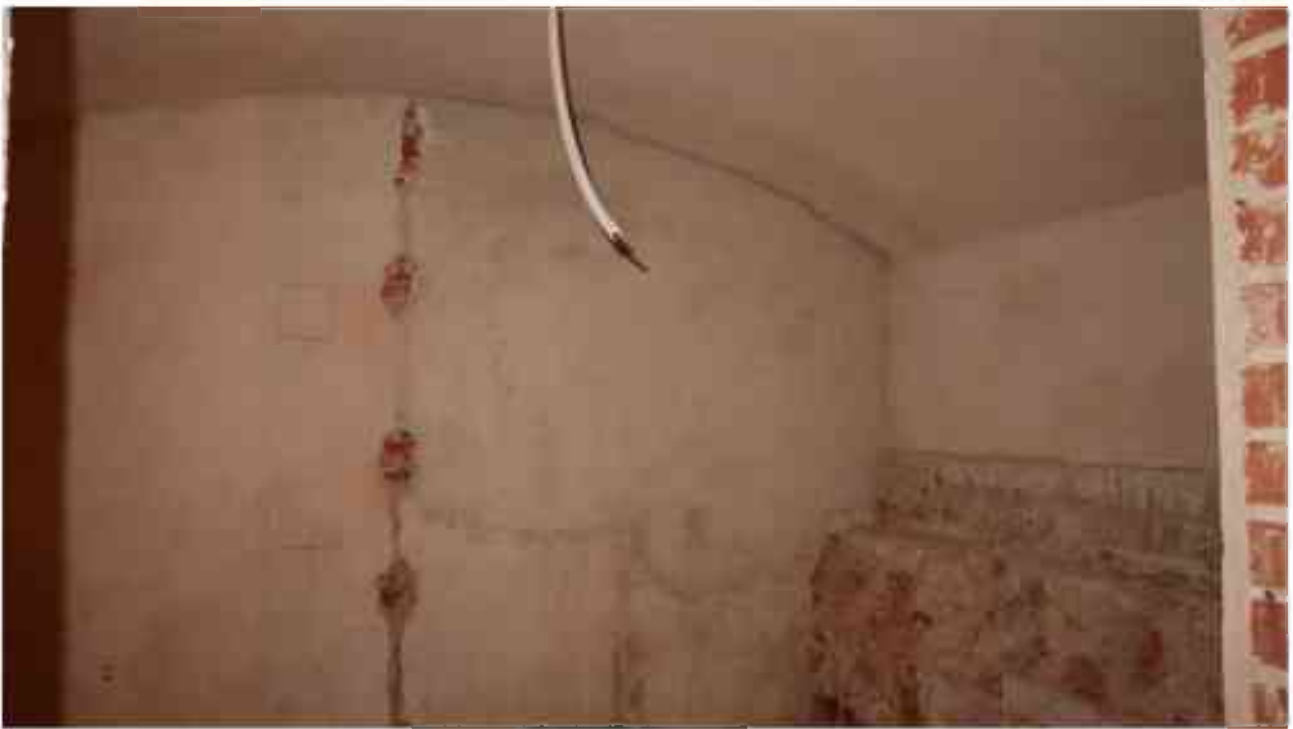
Фото п.272. Подвал, помещение 6Н (11).
