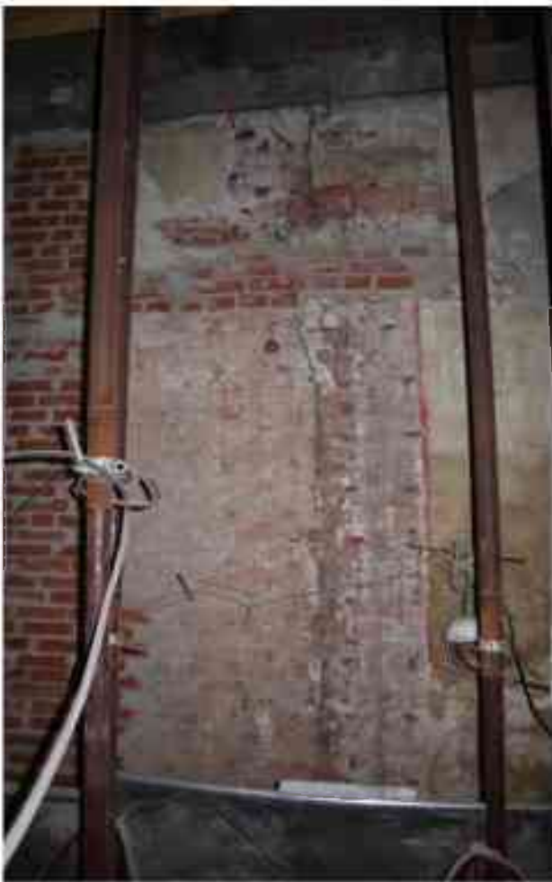
Фото 2.103. 2 этаж, помещение 22Н (33-35, 38-40).
