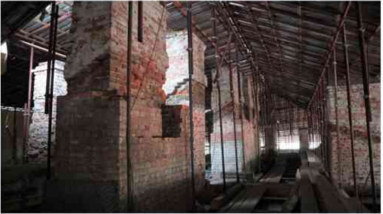
Фото 6.42. 6 этаж, чердачное помещение.
