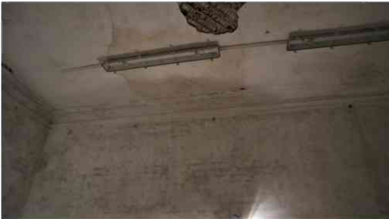
Фото 3.174. 3 этаж, помещение 24Н (1).
