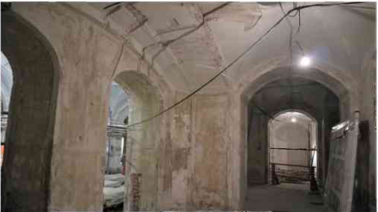
Фото 1.283. 1 этаж, помещение 13Н (4).
