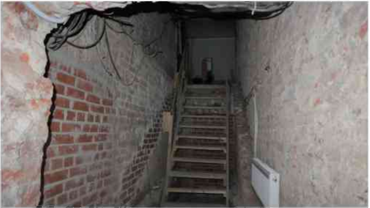
Фото п.181. Подвал, помещение 9Н (6), лестница Л-16.
