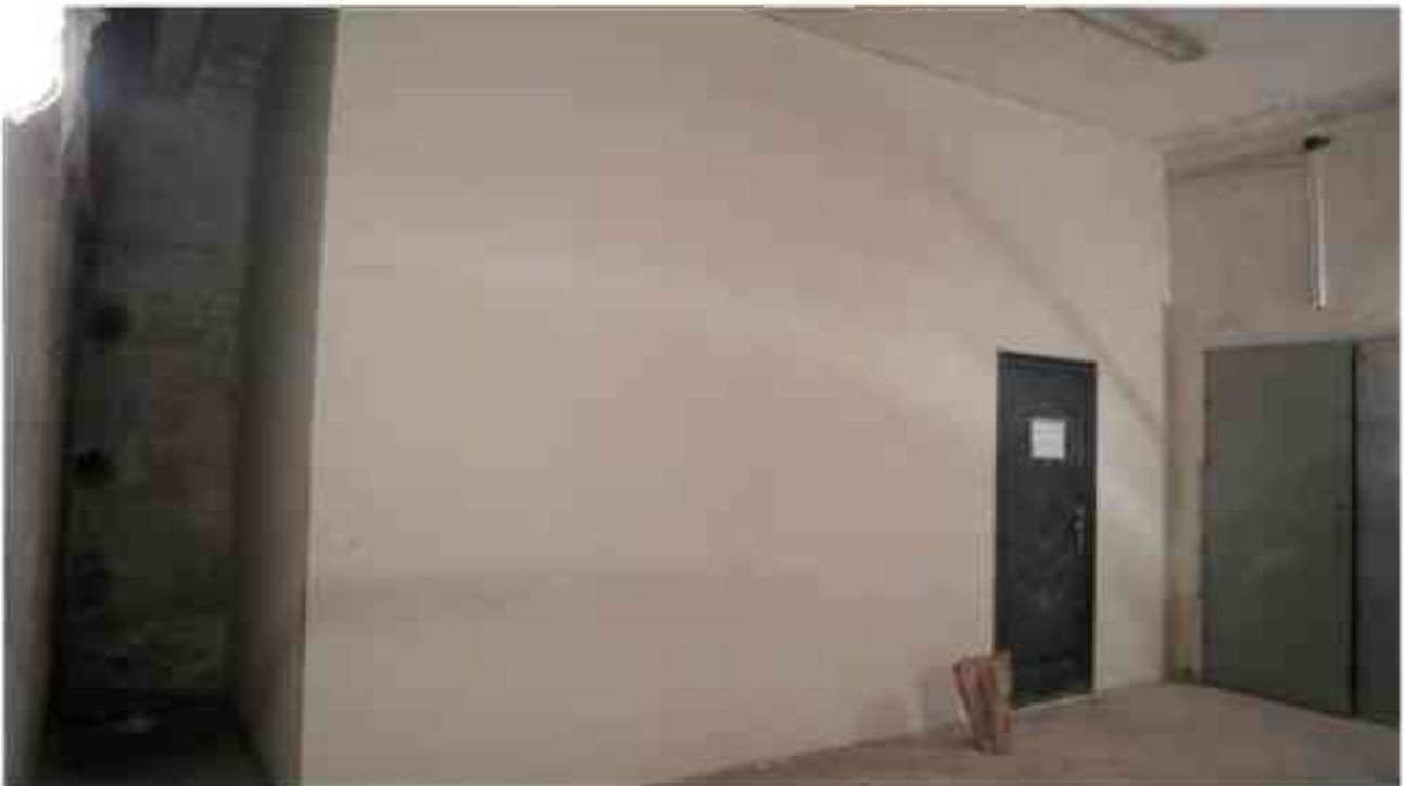
Фото 3.171. 3 этаж, помещение 24Н (1).
