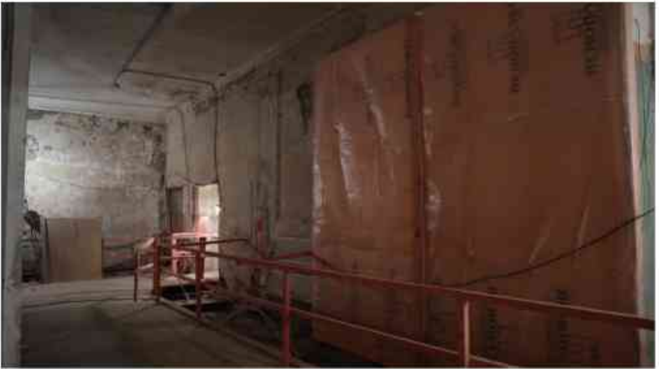
Фото 1.312. 1 этаж, помещение 15Н (1).
