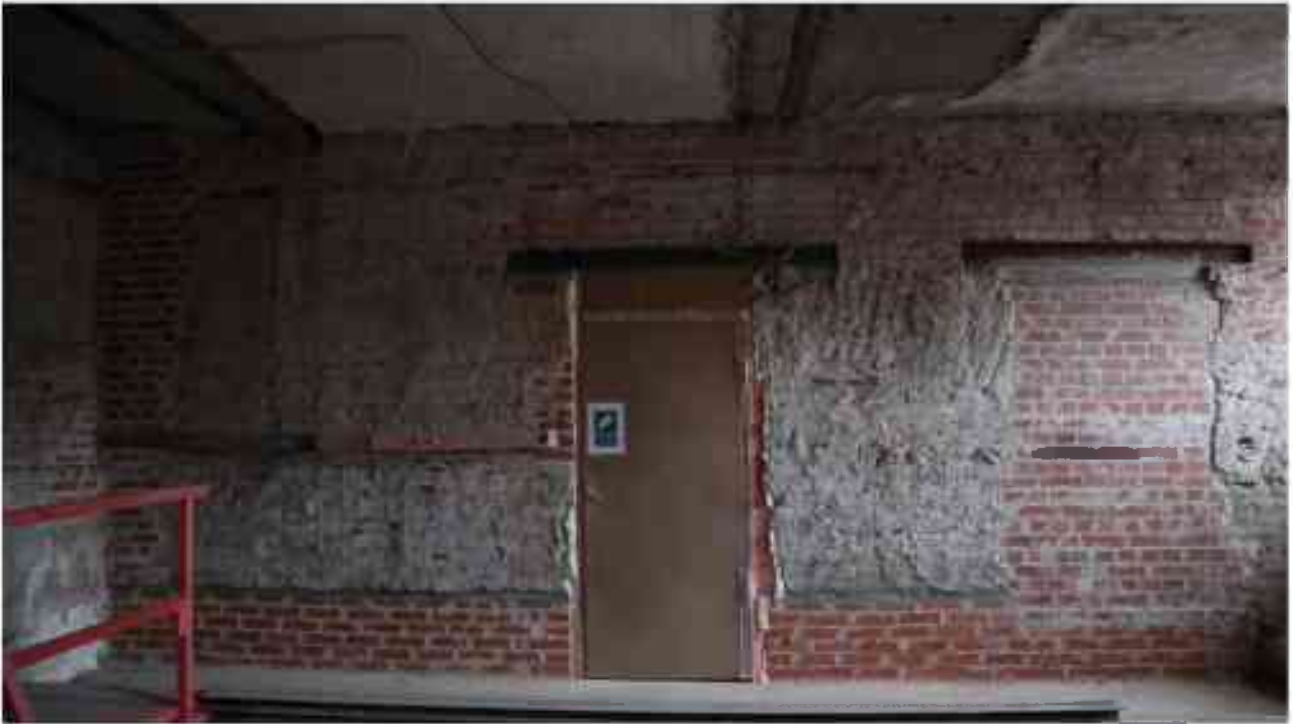
Фото 5.57. 5 этаж, помещение 35Н (8-11).
