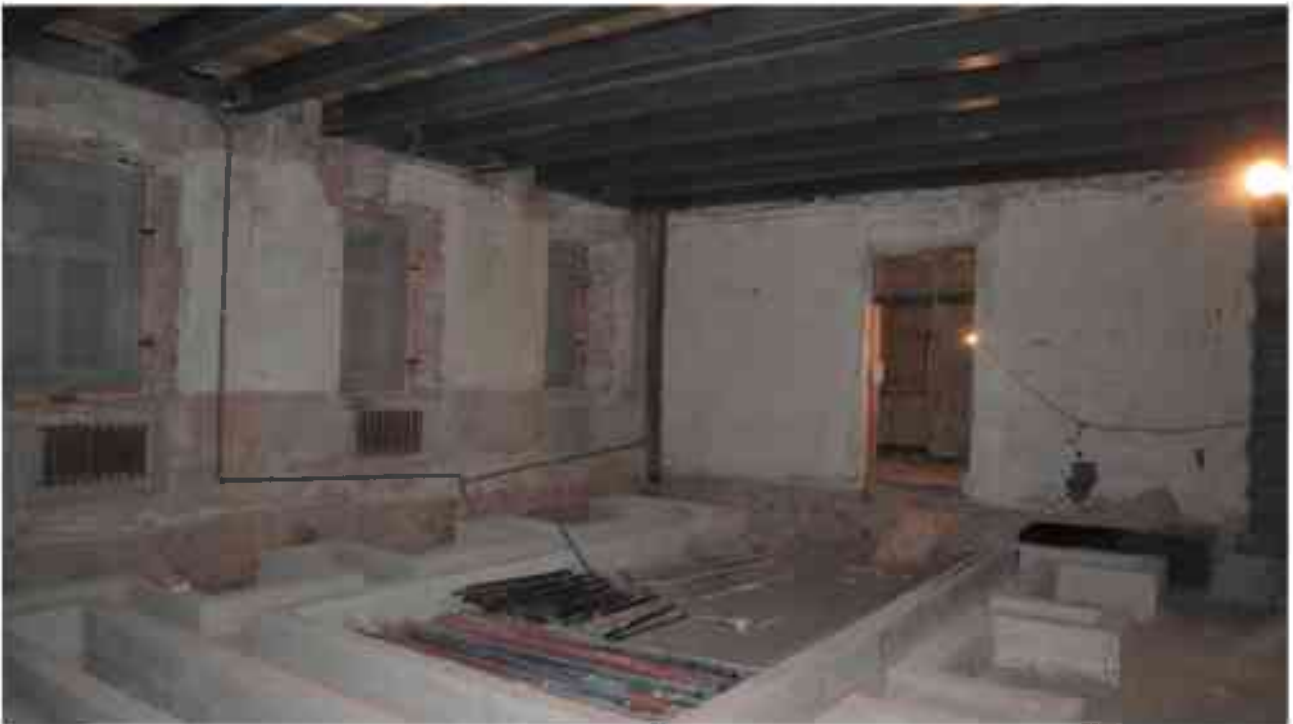
Фото 1.171. 1 этаж, помещение 31Н (19).
