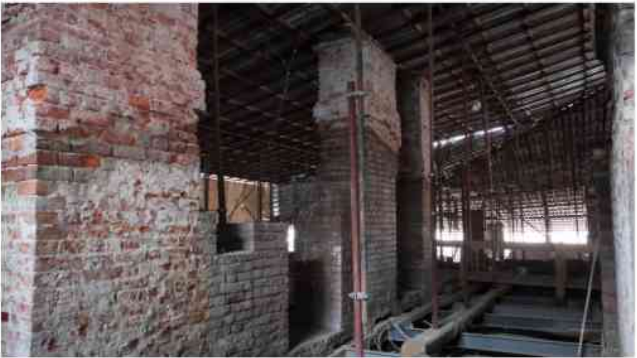
Фото 6.34. 6 этаж, чердачное помещение.
