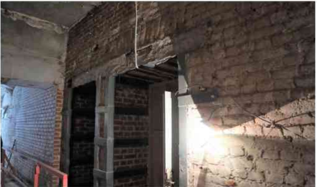
Фото 1.212. 1 этаж, помещение 15Н (5-6).
