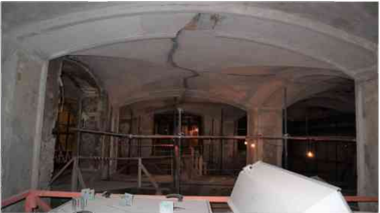
Фото 1.301. 1 этаж, помещение 13Н (4).
