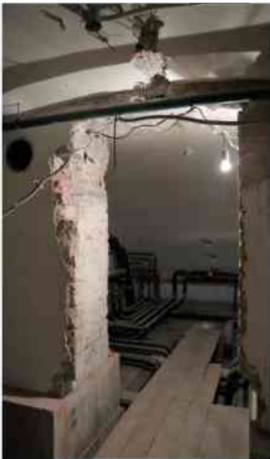
Фото п.165. Подвал, помещение 9Н (10).
