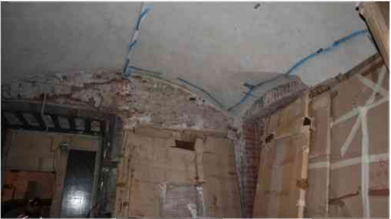
Фото 1.30. 1 этаж, помещение 14Н (16).
