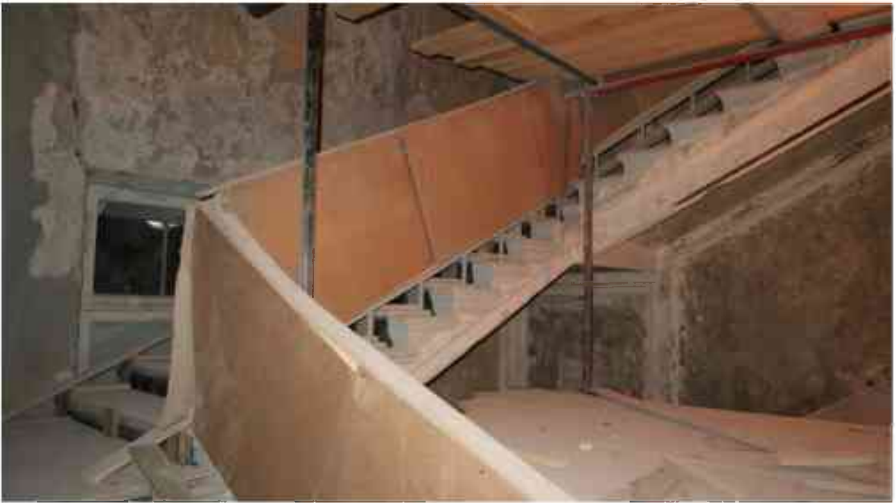
Фото 1.319. 1 этаж, лестница в ризалите южного фасада (западная часть).
