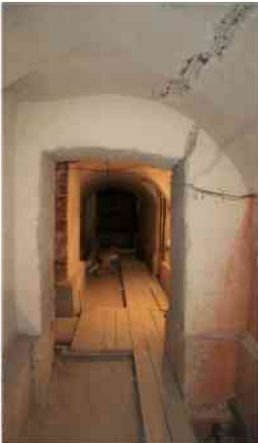
Фото п.203. Подвал, помещение 9Н (25).
