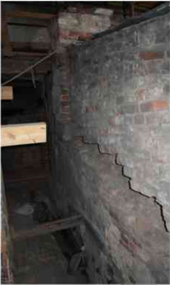
Фото 6.30. 6 этаж, чердачное помещение.
