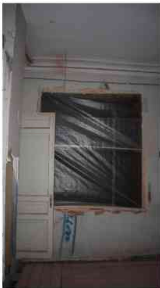
Фото 3.68. 3 этаж, помещение 28Н (5-10).
