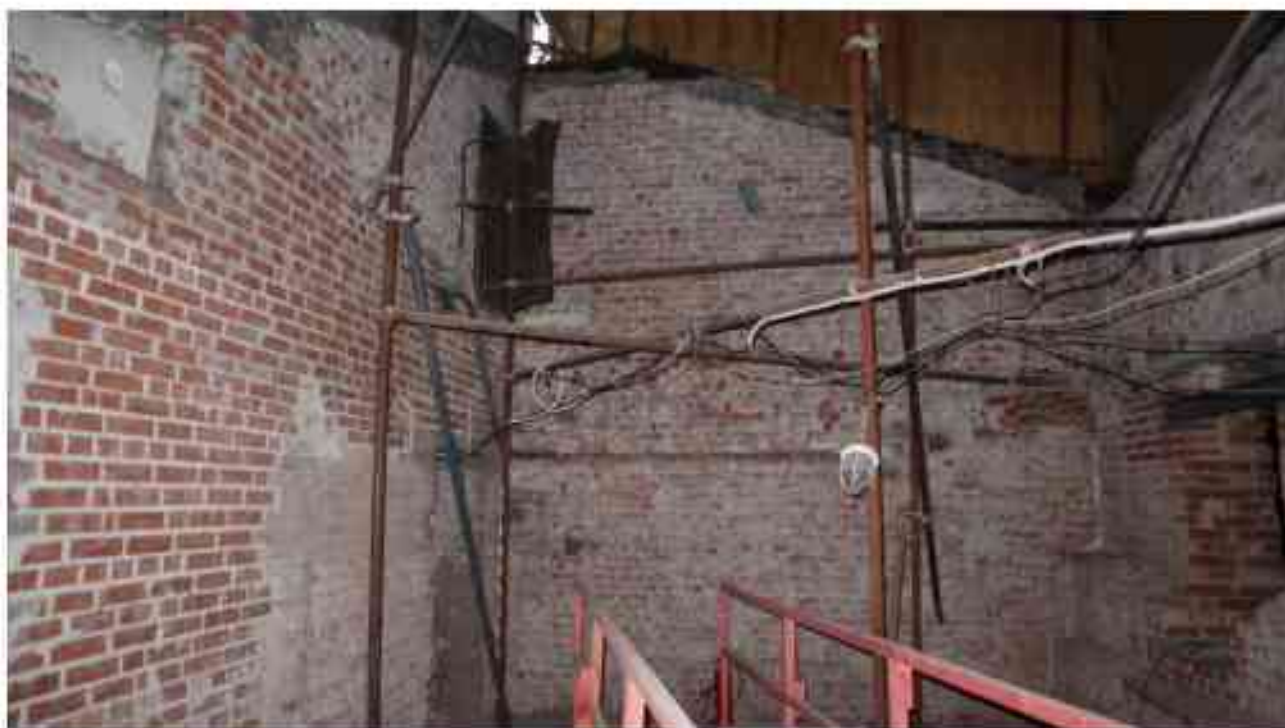
Фото 5.124. 5 этаж, коридор, помещения 34Н/37Н.
