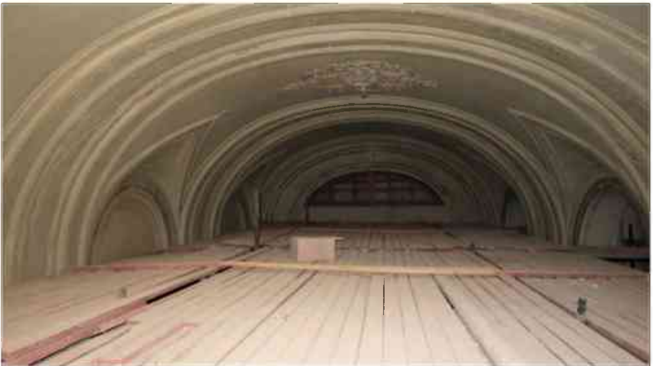
Фото 2.144. 2 этаж, помещение 22Н (19).*
