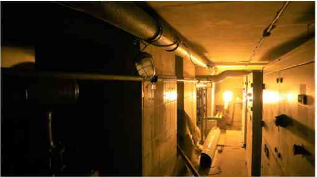
Фото п.310. Подвал, помещение 3Н (16).
