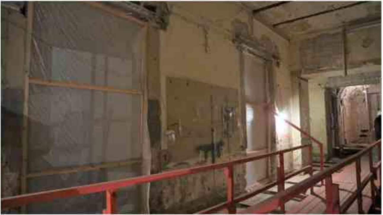
Фото 2.198. 2 этаж, помещение 22Н (10).
