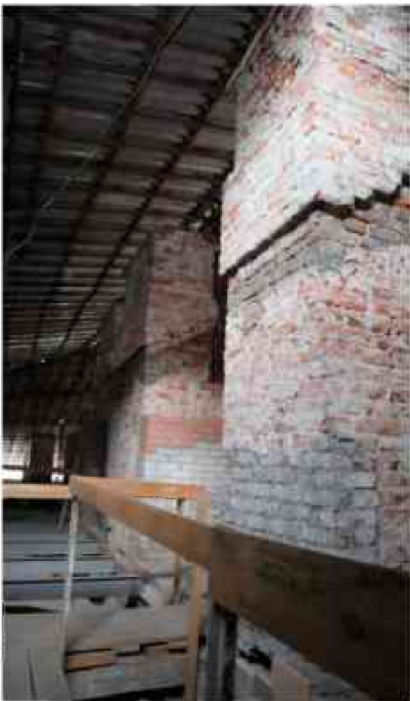
Фото 6.33. 6 этаж, чердачное помещение.
