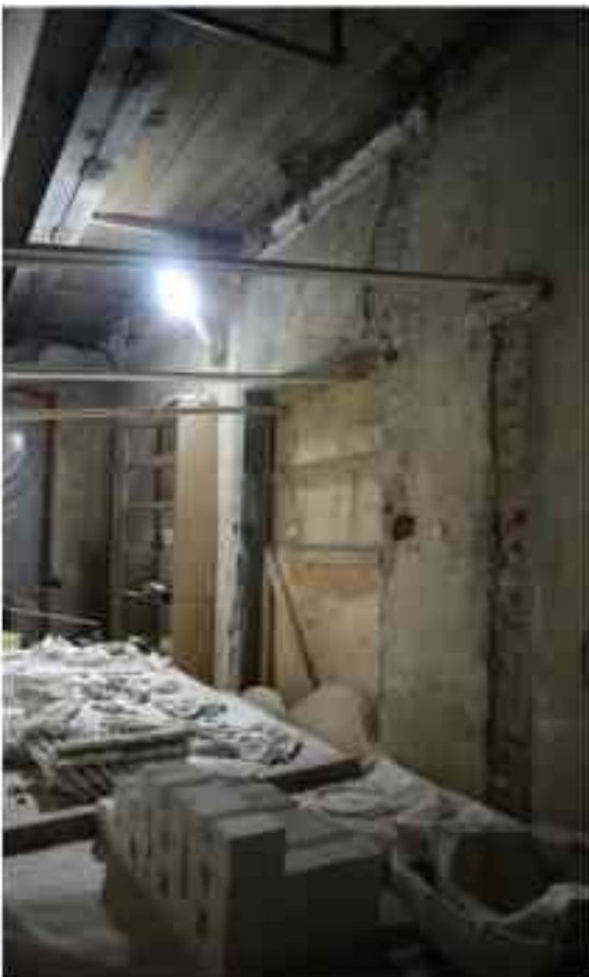
Фото 2.97. 2 этаж, помещение 22Н (33-35, 38-40).
