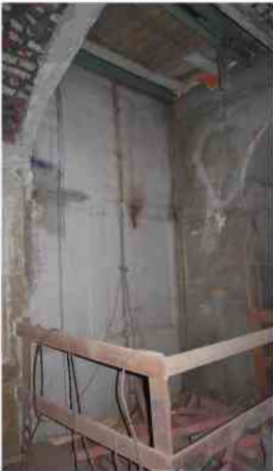
Фото 4.40. 4 этаж, помещение 33Н (30).
