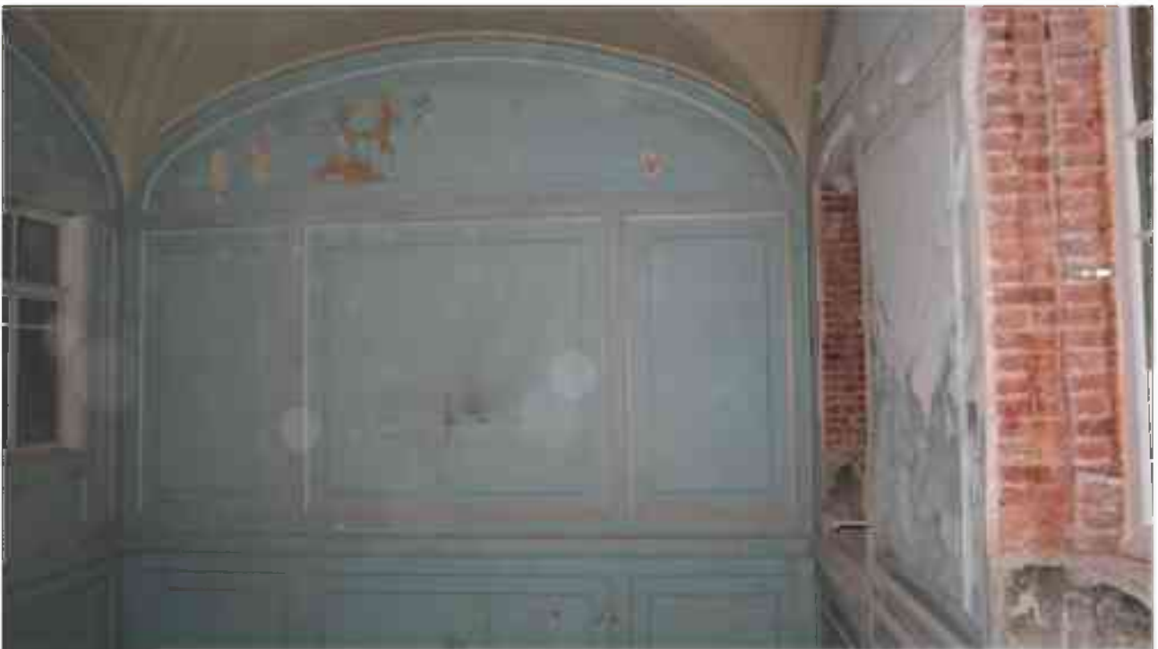
Фото 4.46. 4 этаж, лестница Л-16.
