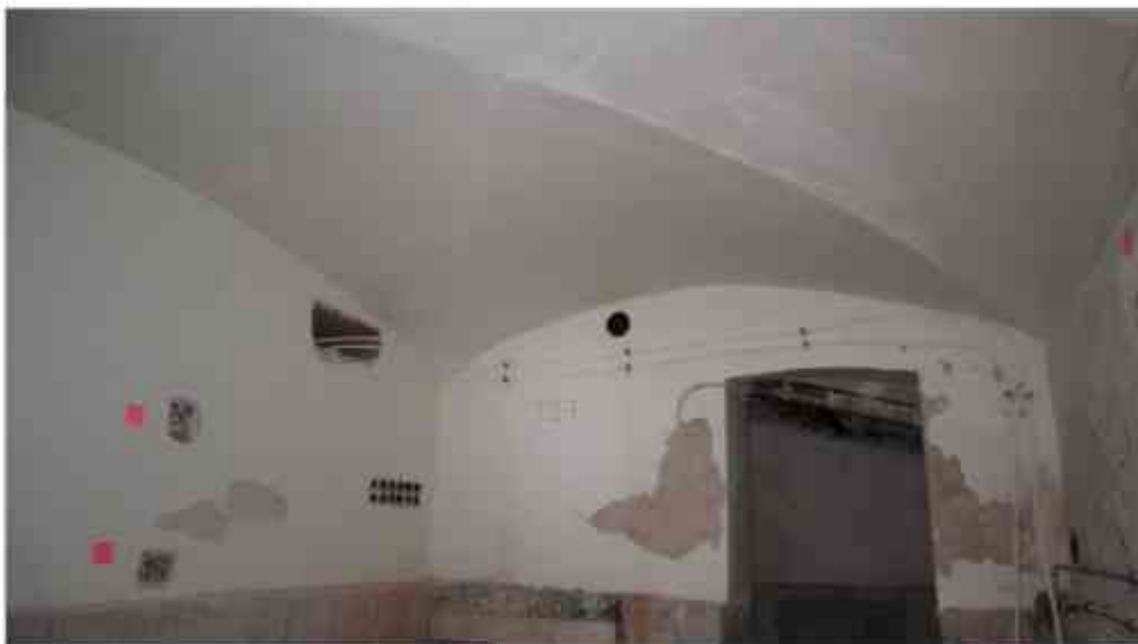
Фото п.210. Подвал, помещение 9Н (7).
