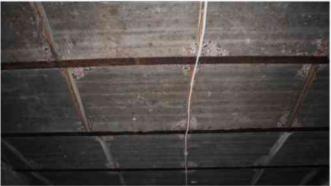
Фото 2.29. 2 этаж, помещение 22Н (68-72, 74-75).
