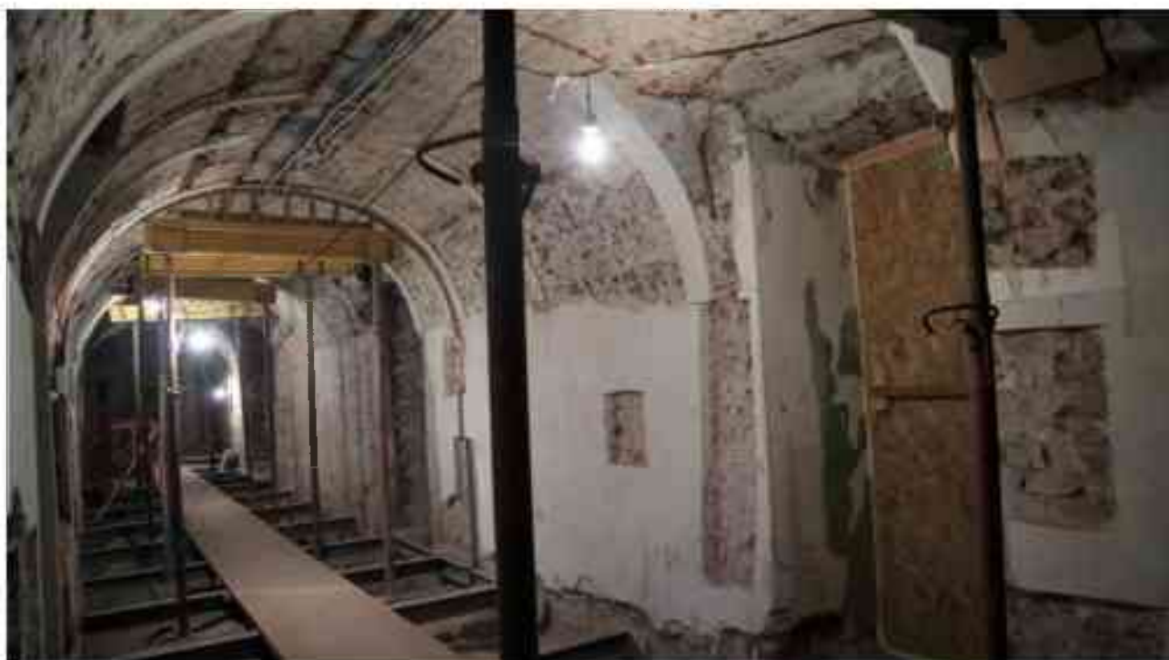
Фото 5.8. 5 этаж, помещение 37Н (1).
