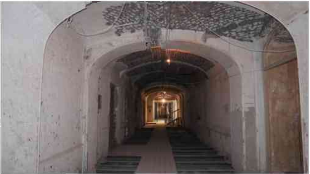
Фото 2.1. 2 этаж, помещение 22Н (41).
