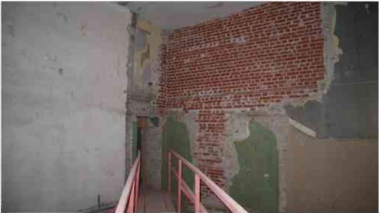
Фото 2.87. 2 этаж, помещение 22Н (76-78, 82, 84).
