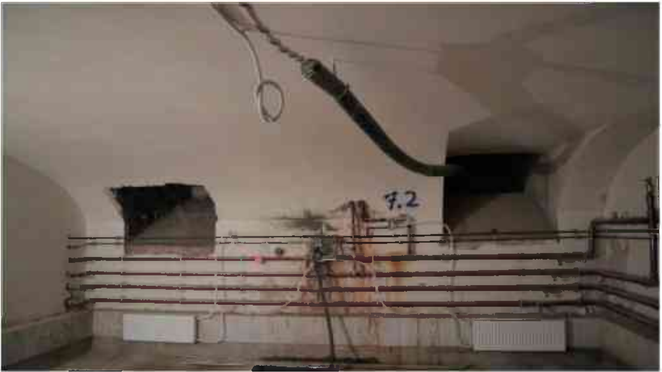
Фото п.254. Подвал, помещение 6Н (3).
