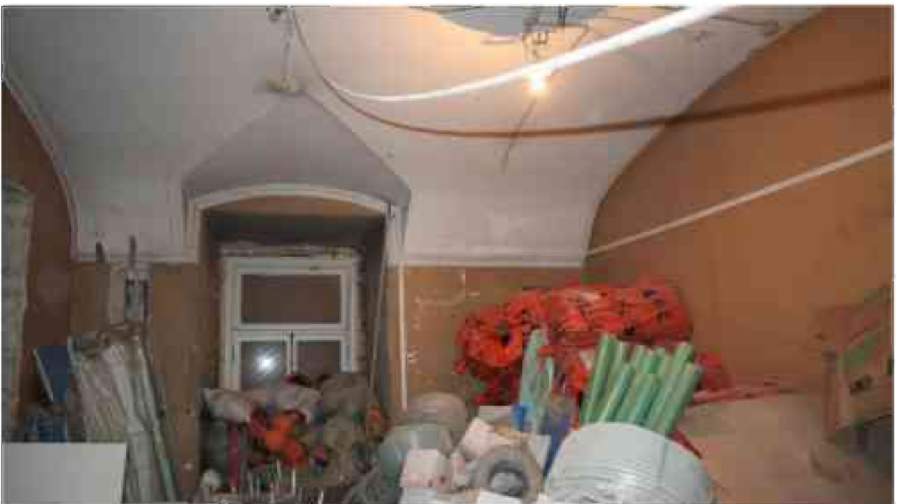
Фото 1.132. 1 этаж, западная часть помещения 31Н (7).
