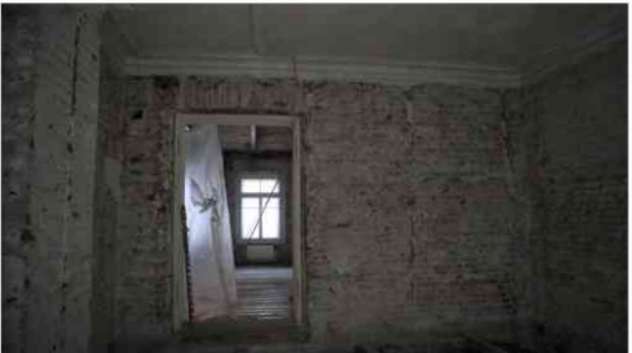
Фото 4.56. 4 этаж, помещение 33Н (29).
