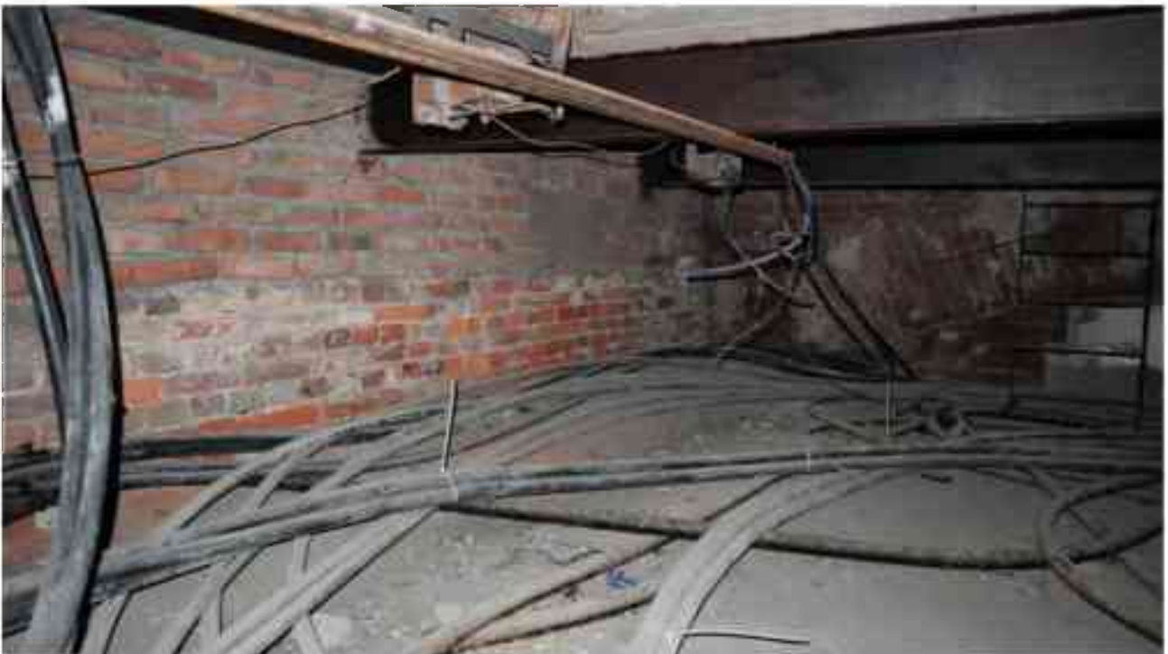
Фото п.345. Подвал, помещение 2Н (6).
