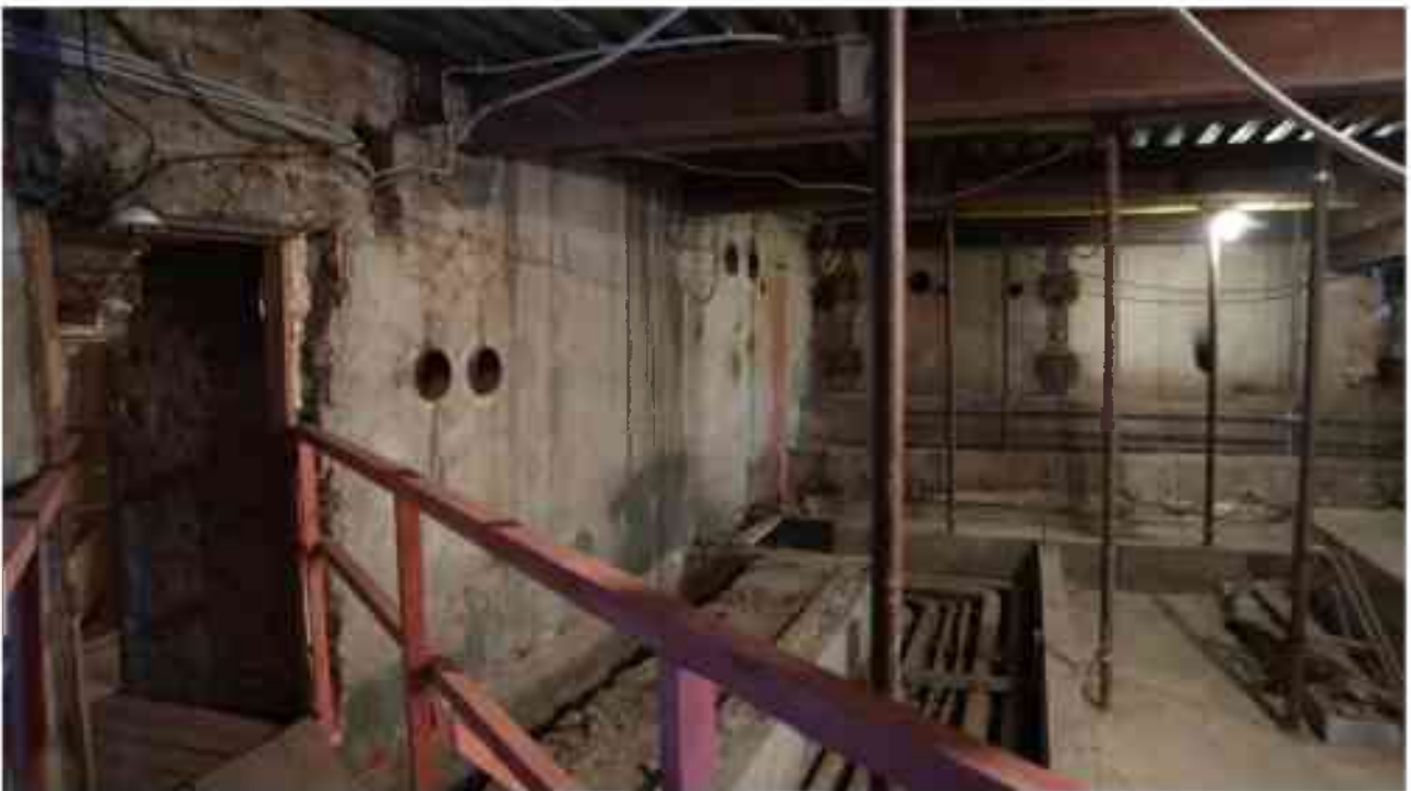
Фото п.29. Подвал, помещение 3Н (5-8).
