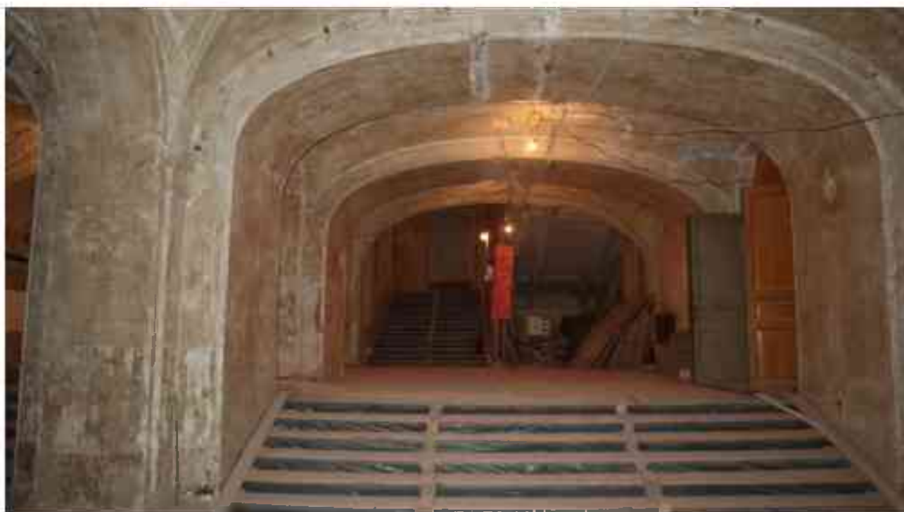
Фото 1.128. 1 этаж, помещение 31Н (1).
