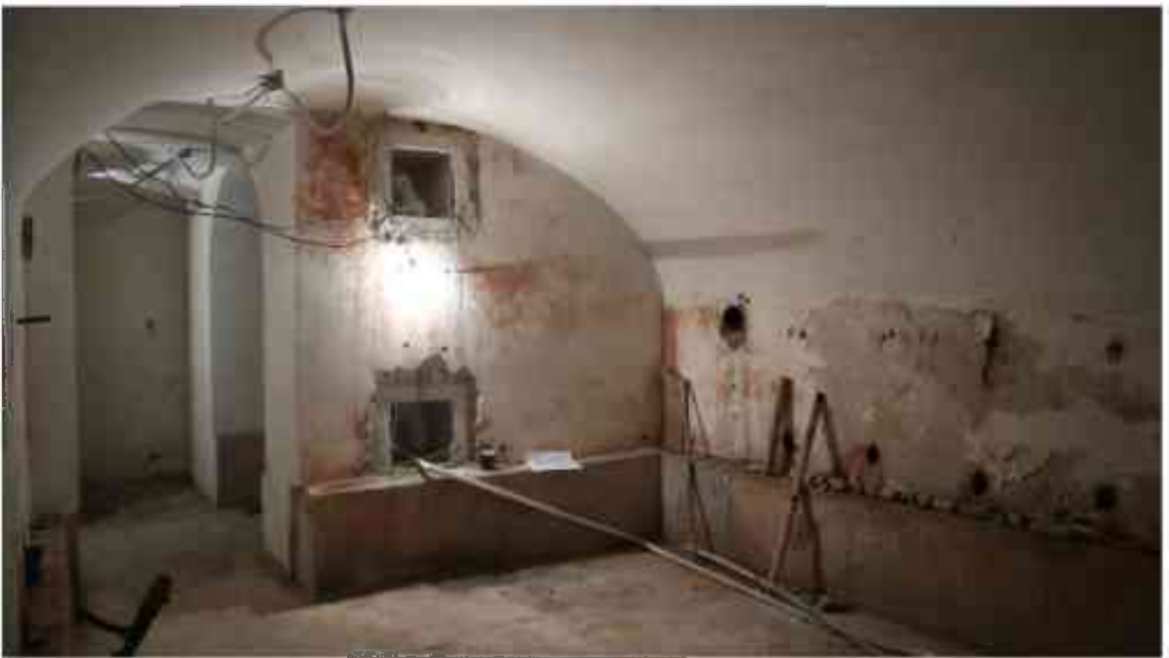
Фото п.97. Подвал, помещение 8Н (8).
