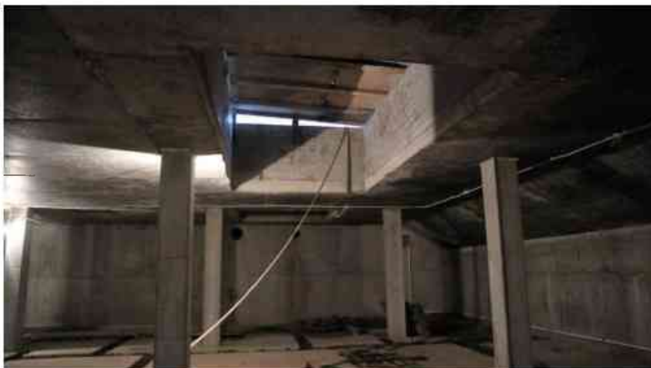
Фото п.240. Подвал, восточного двора.*
