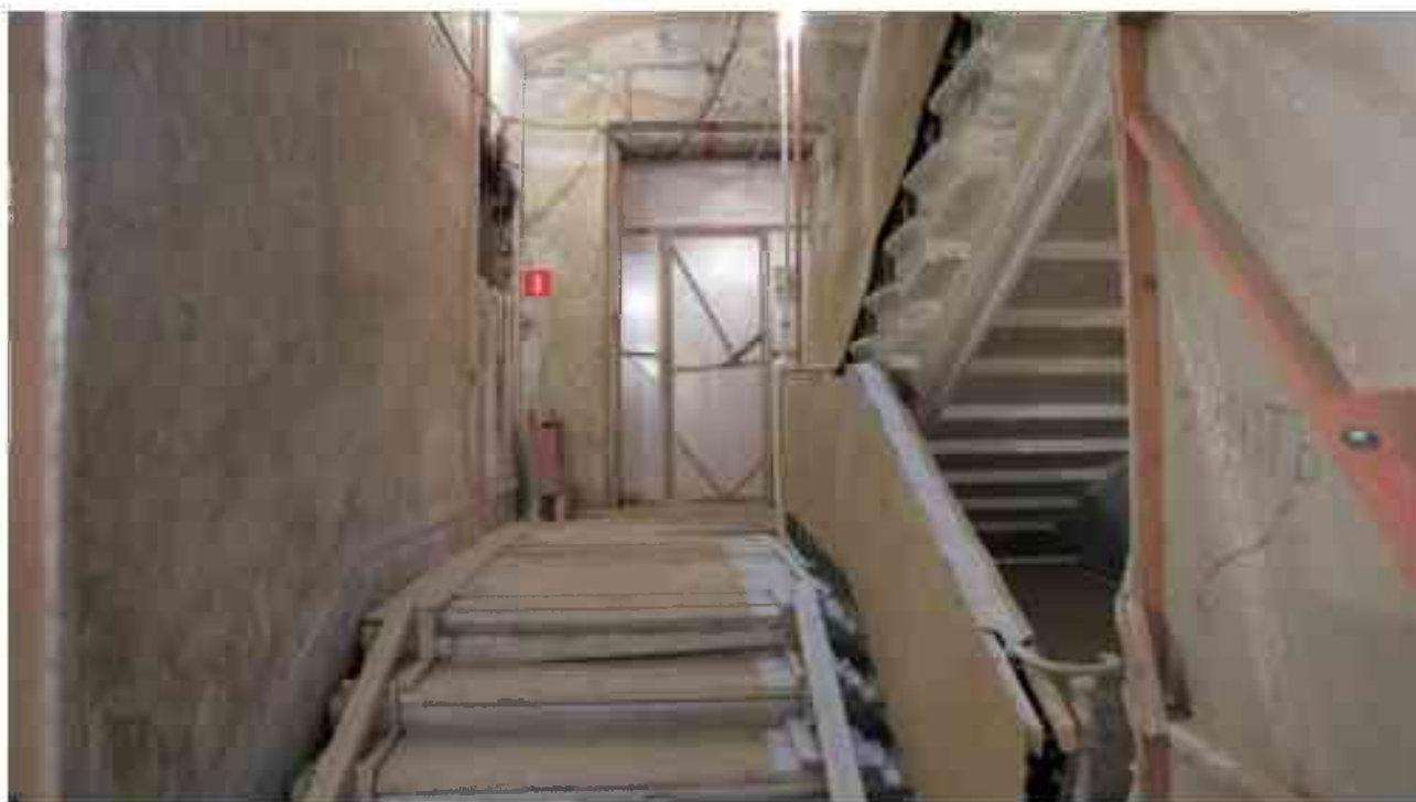
Фото 1.24. 1 этаж, лестница Л-1.
