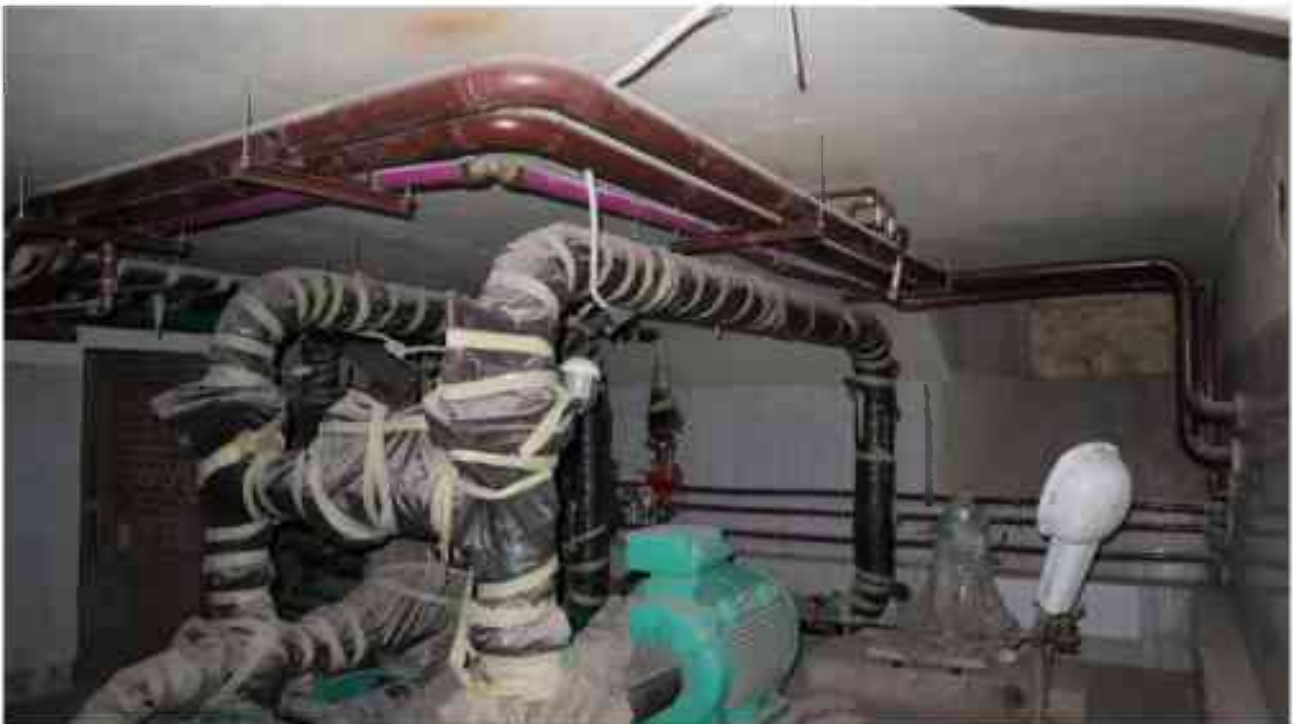
Фото п.169. Подвал, помещение 9Н (9).
