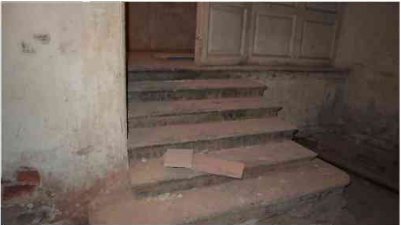
Фото 1.173. 1 этаж, помещение 31Н (18-19).
