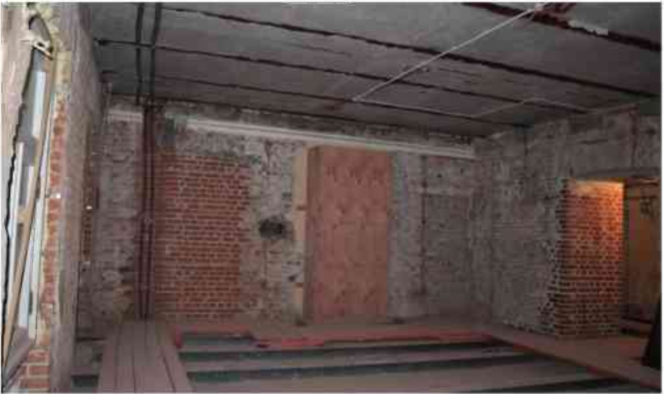
Фото 4.85. 4 этаж, помещение 33Н (5-6).
