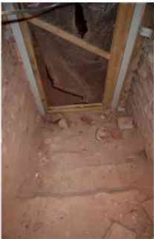
Фото 1.349. 1 этаж, помещение в центре здания, западнее лестницы с перекрестными маршами.*
