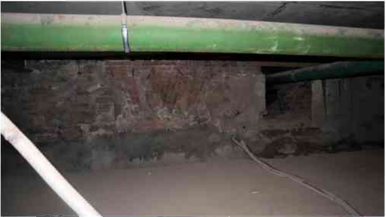
Фото п.301. Подвал, помещение 3Н (16).
