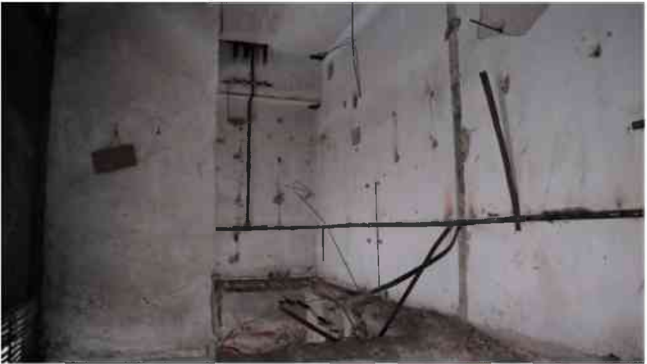
Фото 1.330. 1 этаж, помещение 16Н (1).
