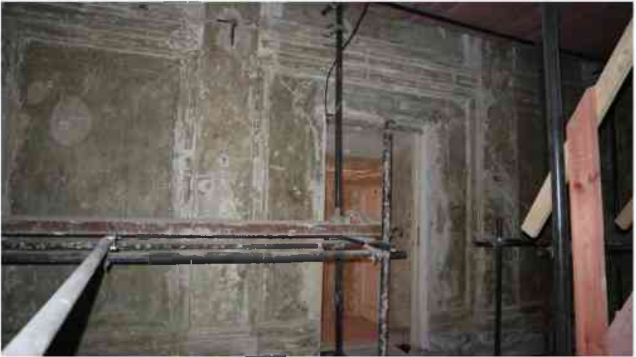
Фото 3.148. 3 этаж, помещение 25Н (11).
