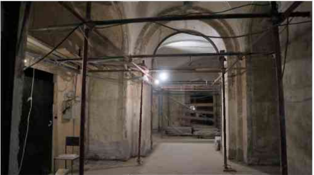
Фото 1.273. 1 этаж, помещение 13Н (21-23).
