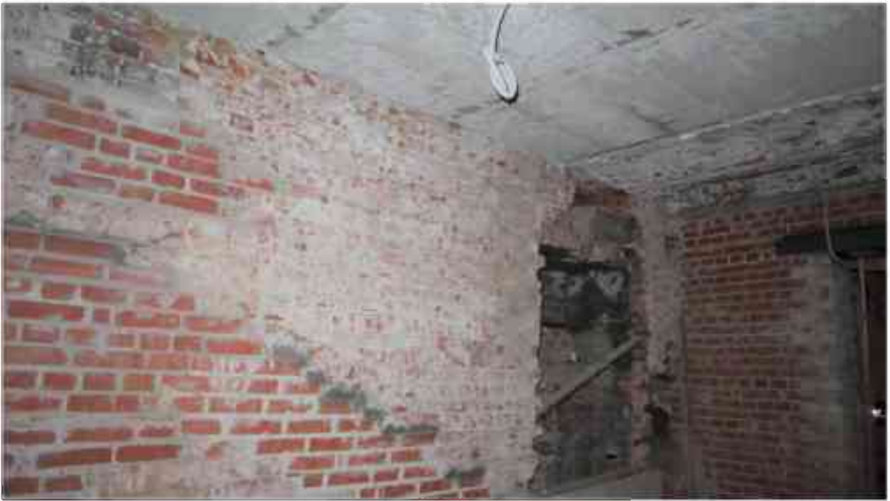
Фото 5.88. 5 этаж, помещение 34Н(12).
