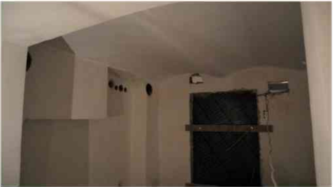
Фото п.142. Подвал, помещение 9Н (26).
