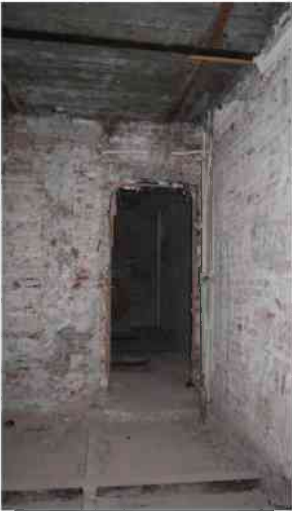
Фото 4.26. 4 этаж, помещение 33Н (33).
