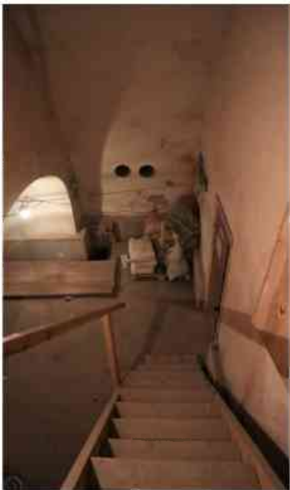
Фото п.79. Подвал, помещение 4Н (13).
