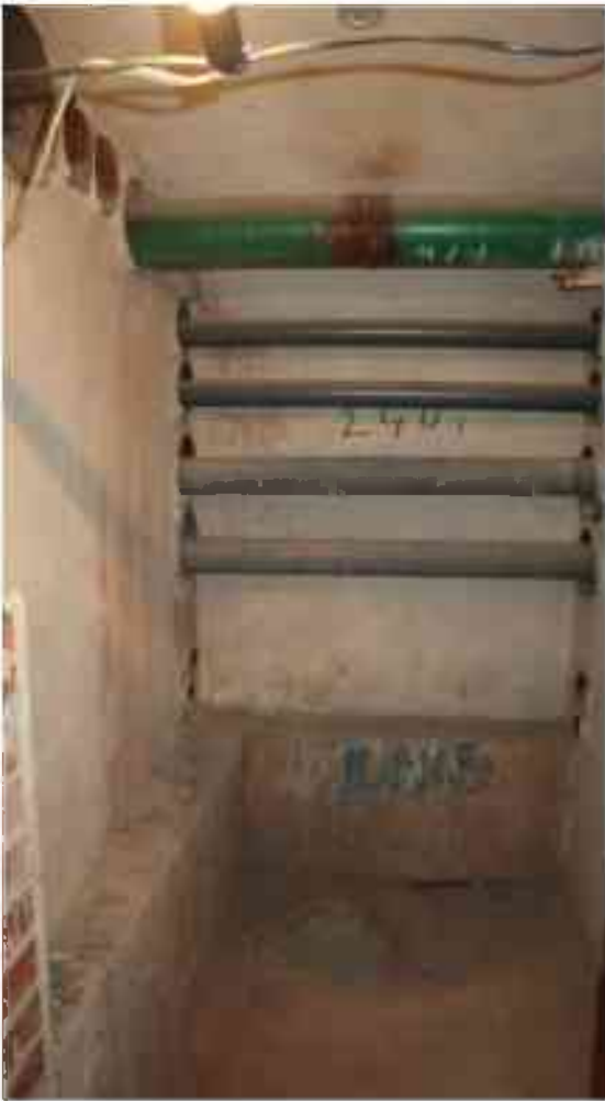
Фото п.197. Подвал, помещение 9Н (21).
