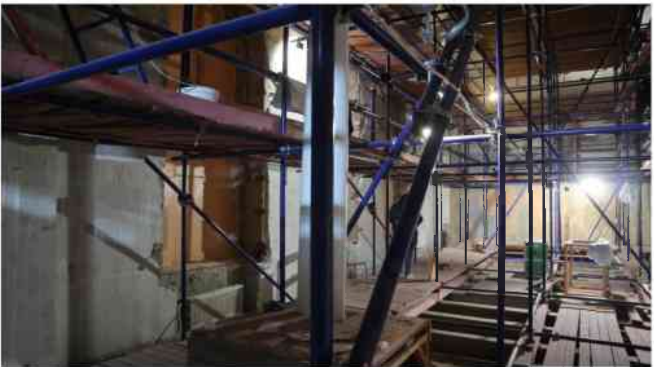
Фото 3.43. 3 этаж, помещение 28Н (20-21).
