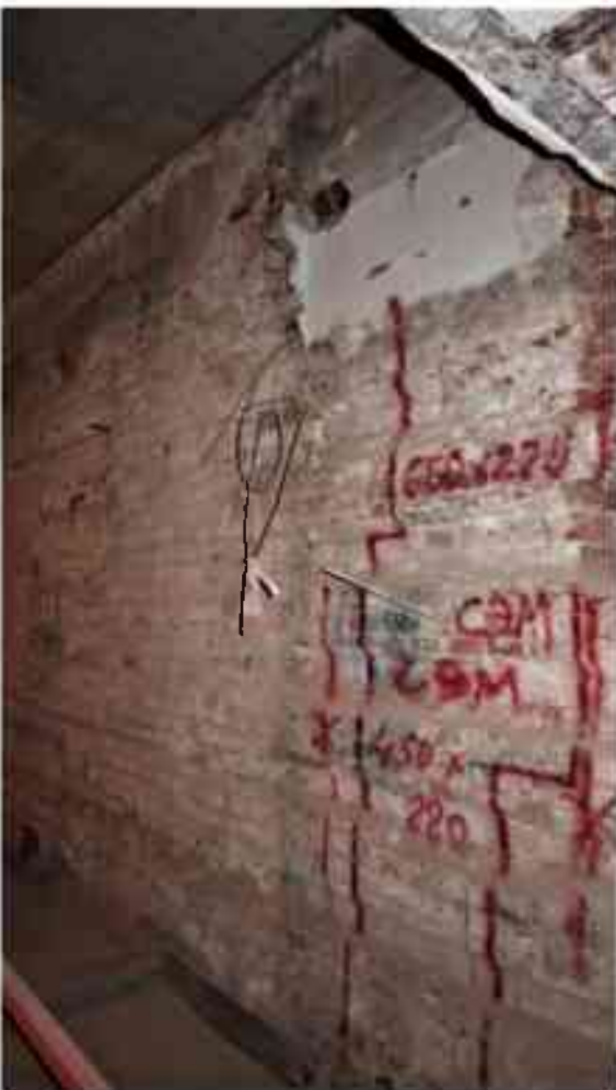
Фото 1.210. 1 этаж, помещение 15Н (5-6).
