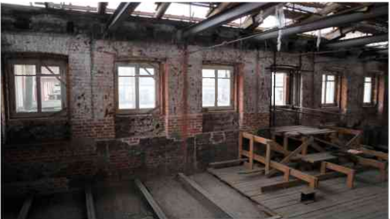
Фото 5.141. 5 этаж, жилой блок, на плане ПИБ 2000г. обозначен как квартиры, помещение (9-19).
