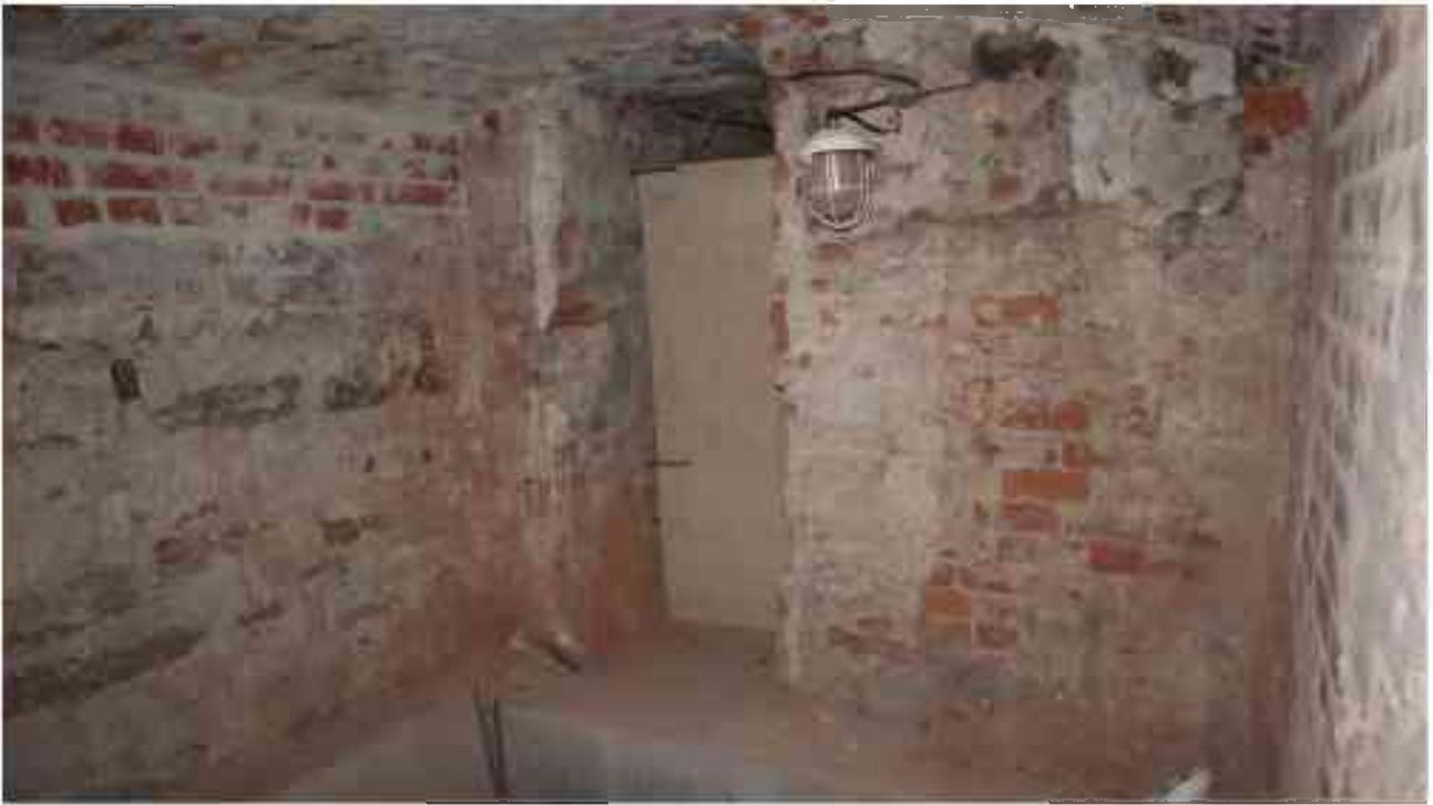
Фото п.297. Подвал, помещение 7Н (1).
