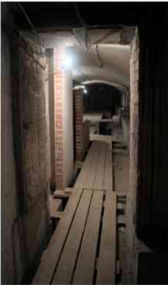
Фото п.186. Подвал, помещение 9Н (21).
