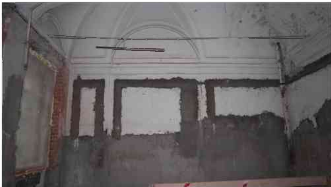
Фото 4.172. 4 этаж, помещение 30Н (8, 10-11).
