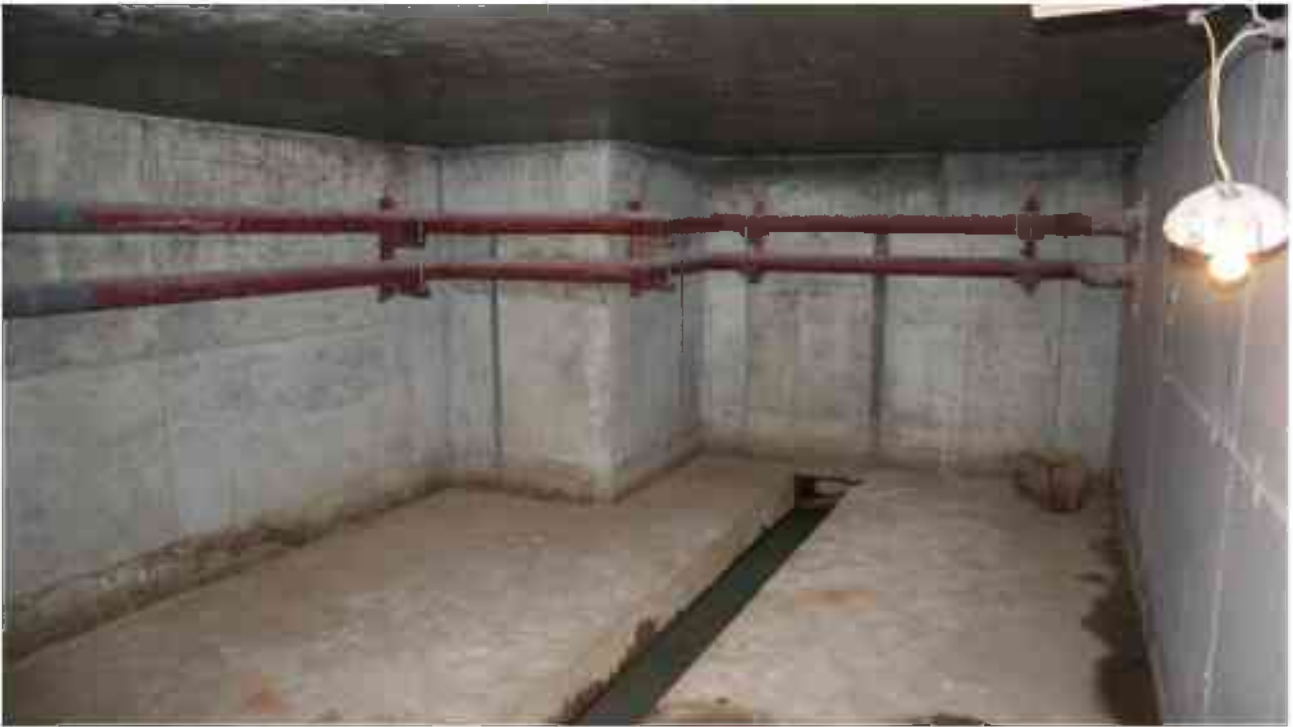
Фото п.103. Подвал, помещение под аркой восточного двора.*
