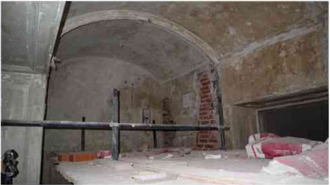
Фото 2.75. 2 этаж, помещение 22Н (31).*
