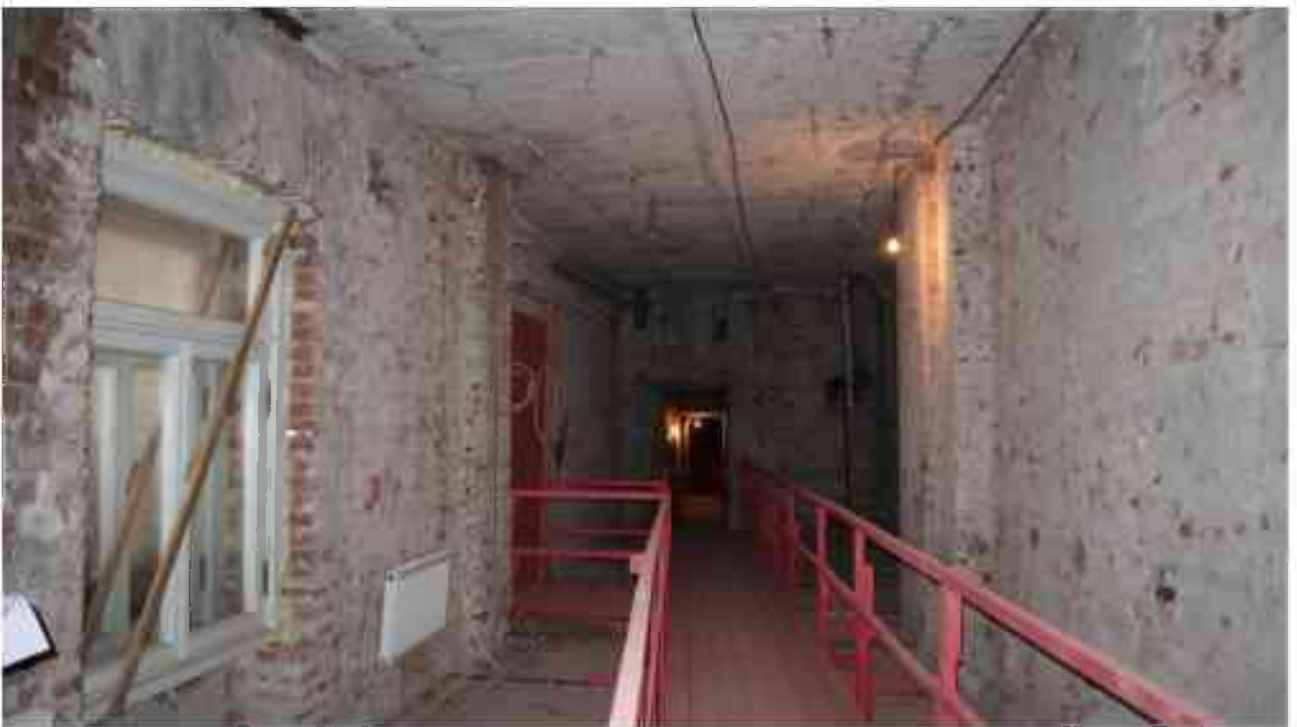
Фото 4.116. 4 этаж, коридор, помещение 29Н (3-4).
