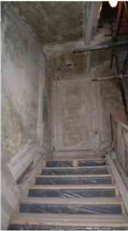
Фото 1.344, 1.345. 1 этаж, лестница с перекрестными маршами, трехмаршевая, в центре здания.*
