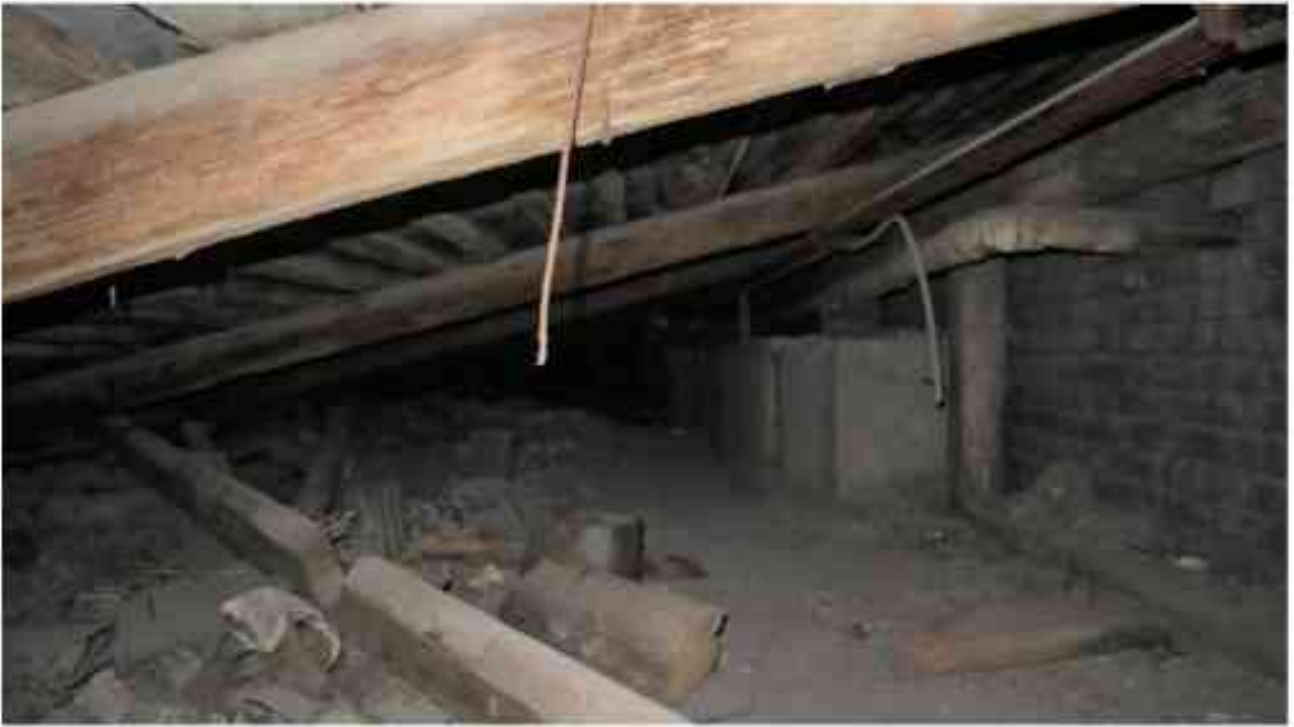
Фото 6.52. 6 этаж, чердачное помещение.
