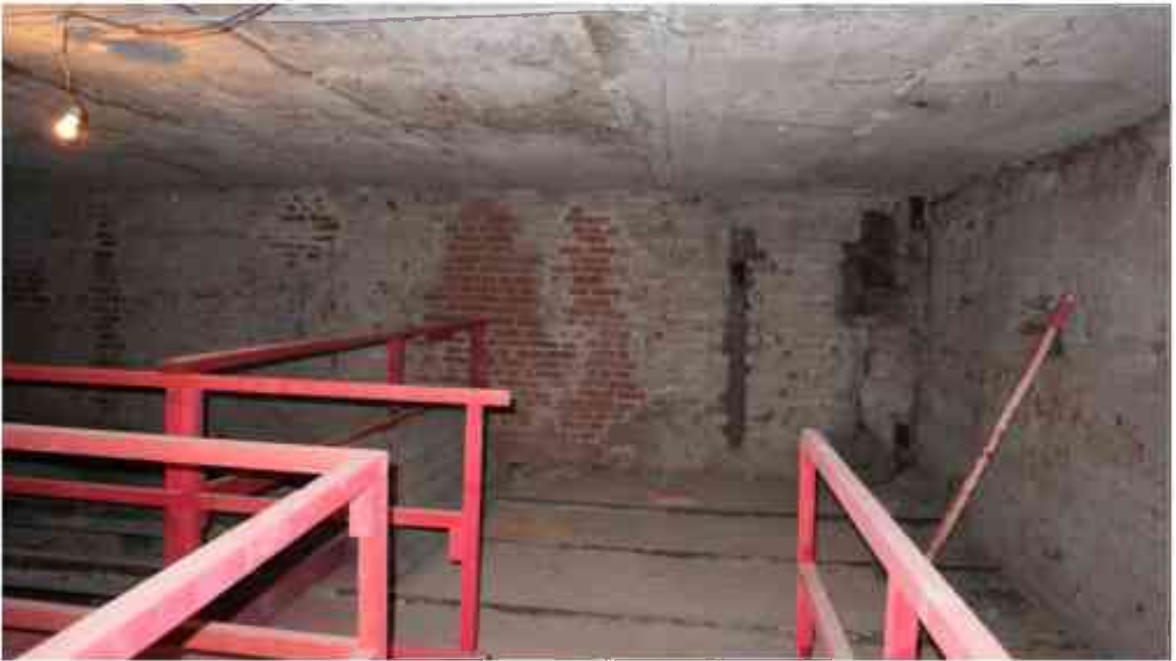
Фото 5.42. 5 этаж, помещение 38Н (2).
