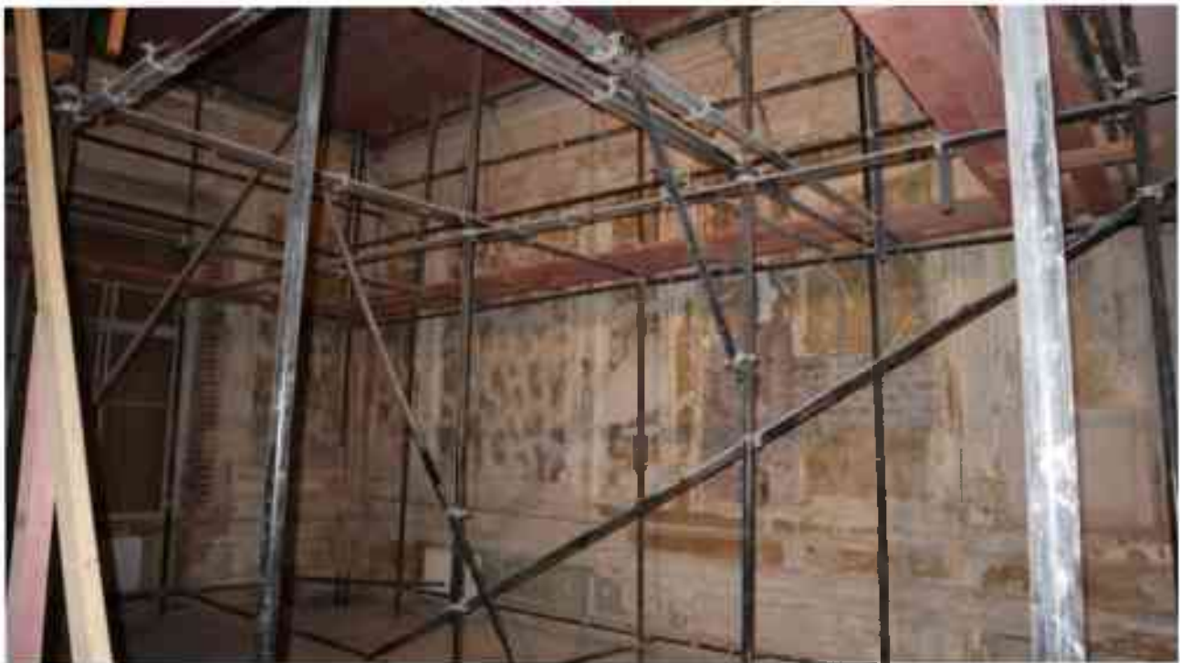
Фото 2.130. 2 этаж, помещение 22Н (18).
