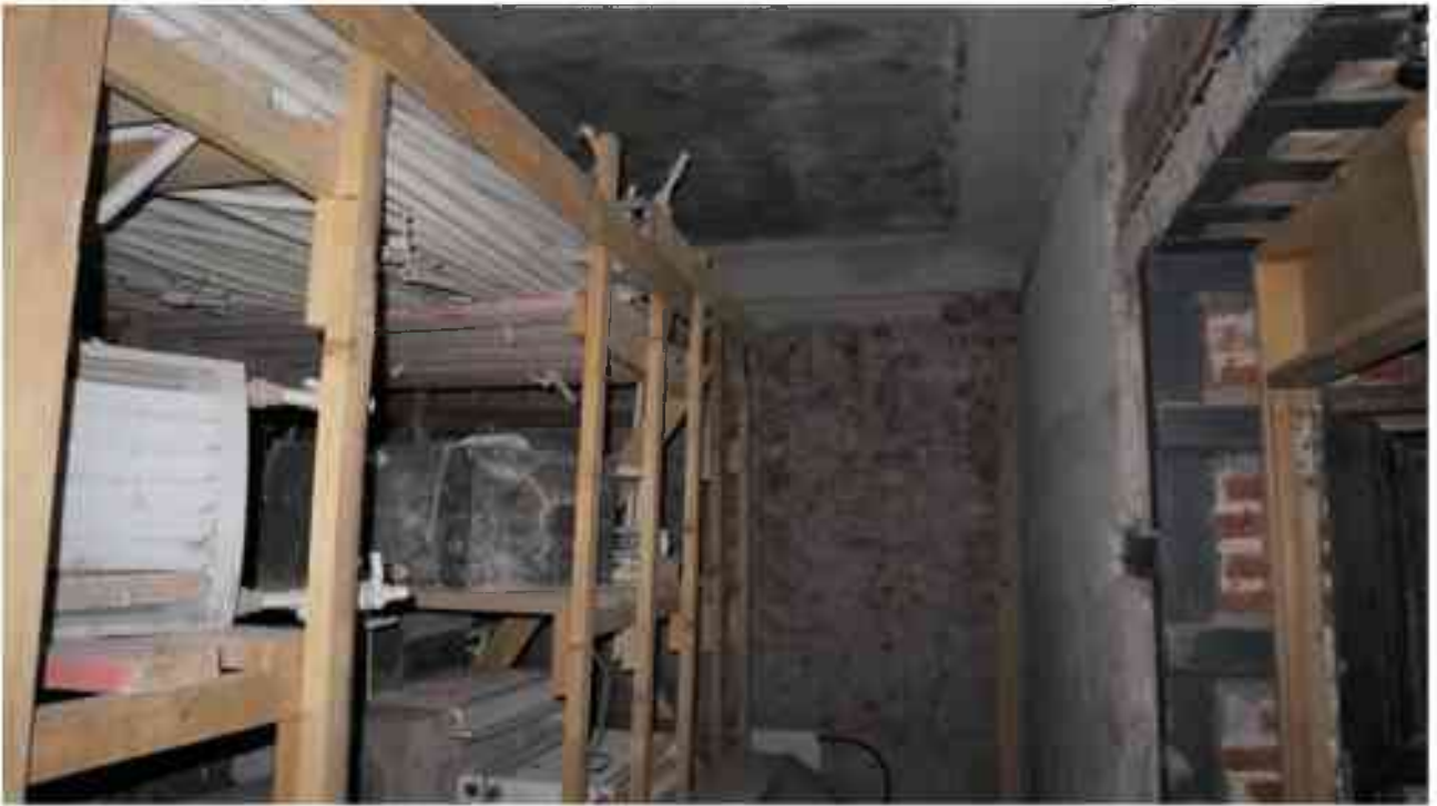
Фото 1.231. 1 этаж, помещение 15Н (3).
