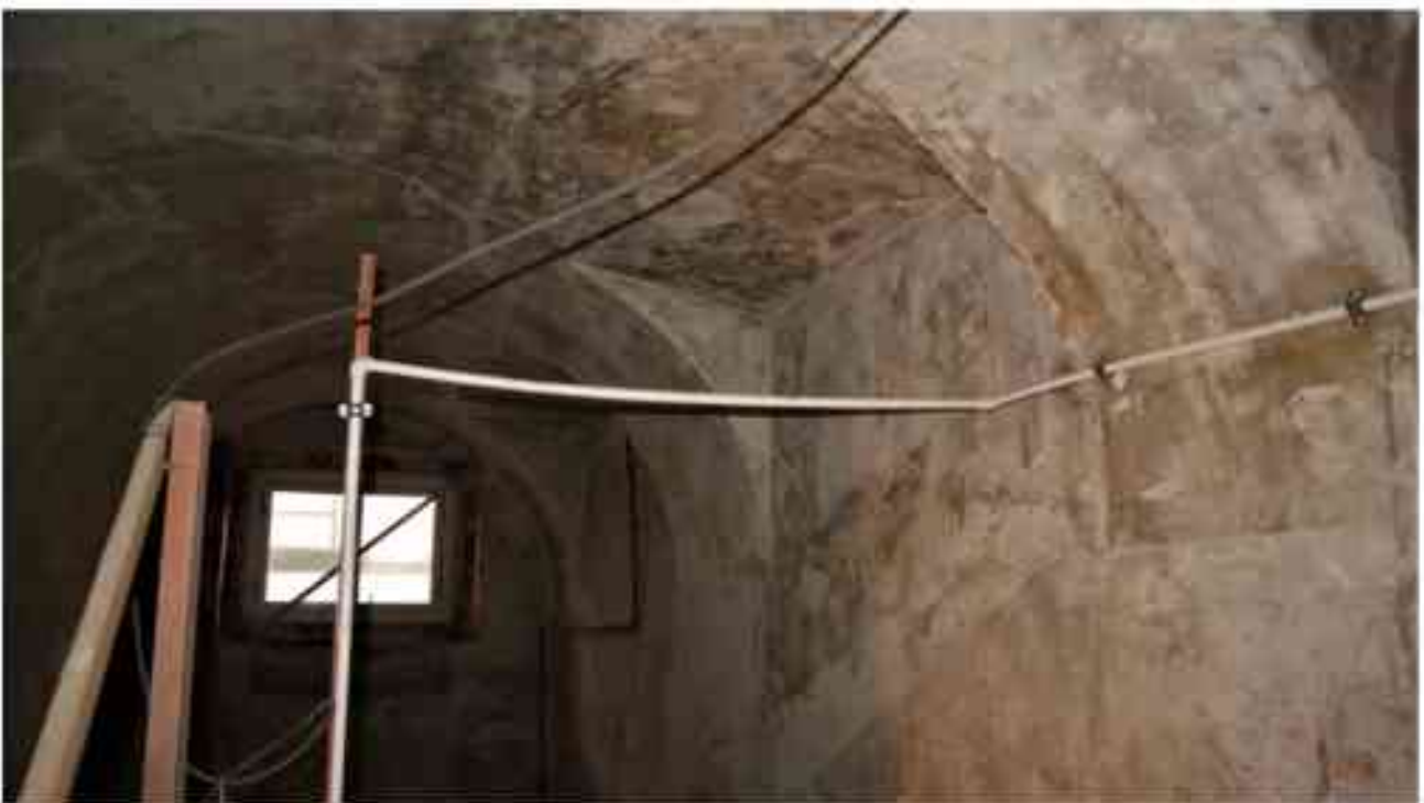
Фото 5.35. 5 этаж, лестница Л-6.
