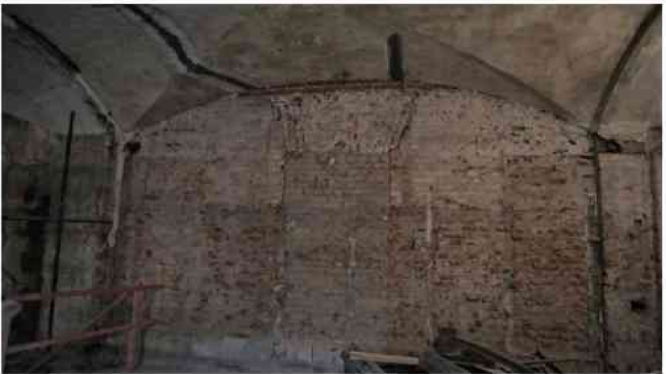
Фото 1.305. 1 этаж, помещение 13Н (3).
