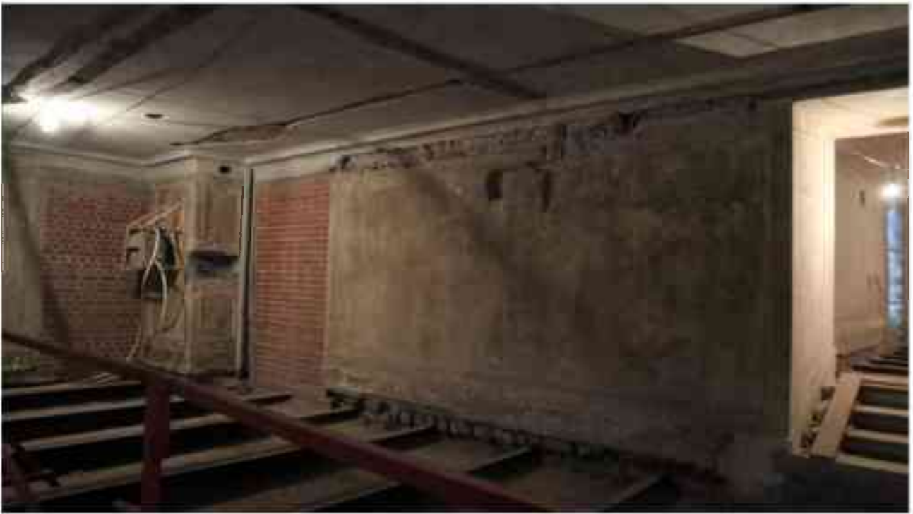
Фото 3.124. 3 этаж, помещение 25Н (5).
