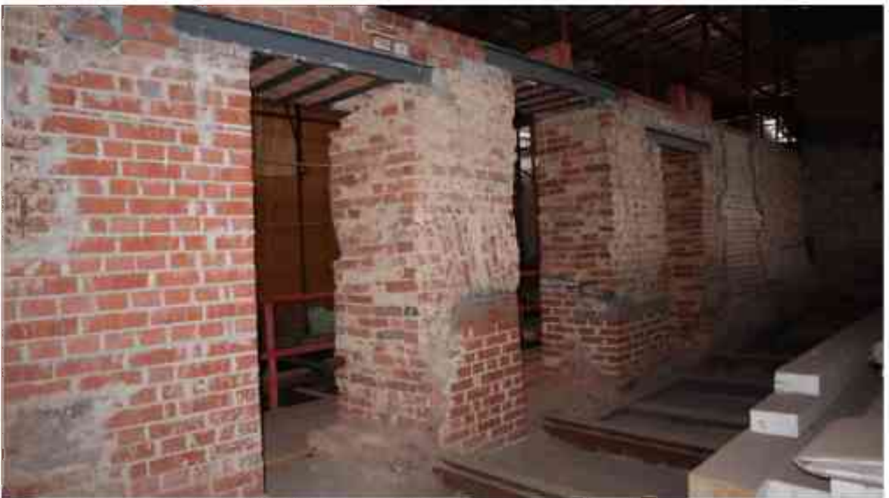
Фото 5.169. 5 этаж, чердачное помещение.
