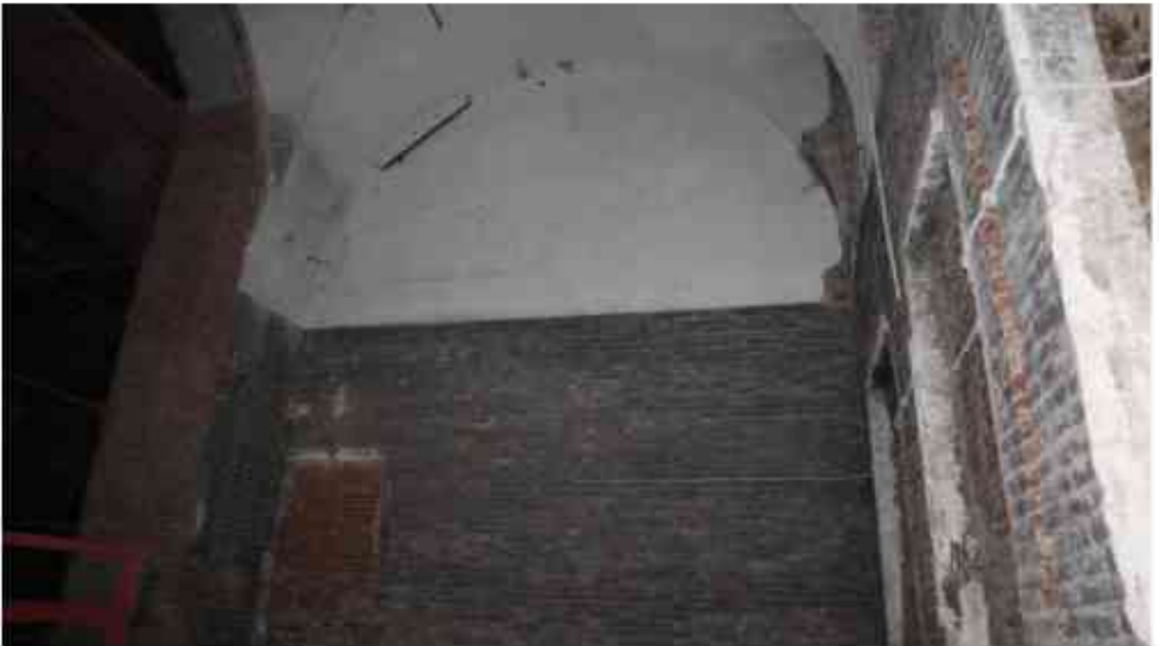
Фото 2.213. 2 этаж, помещение 22Н (83).
