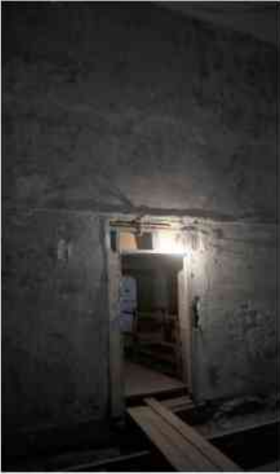
Фото 2.186. 2 этаж, помещение 22Н (25).
