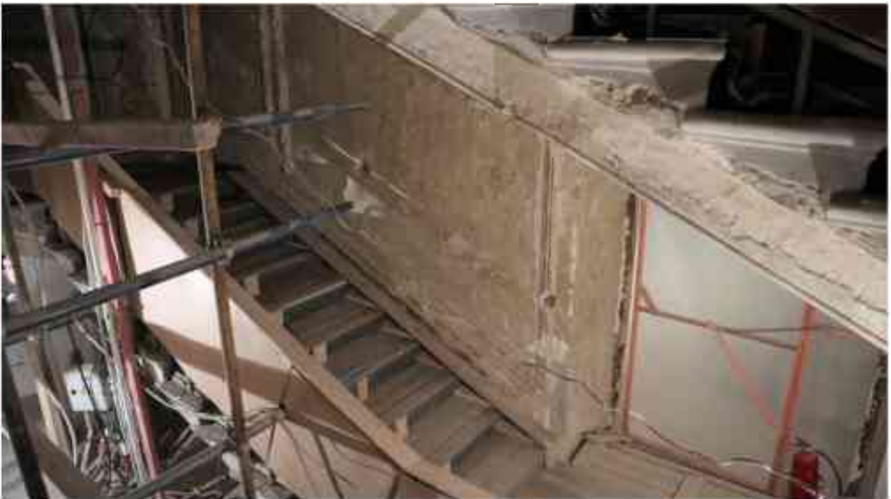
Фото 1.324. 1 этаж, лестница Л-10.
