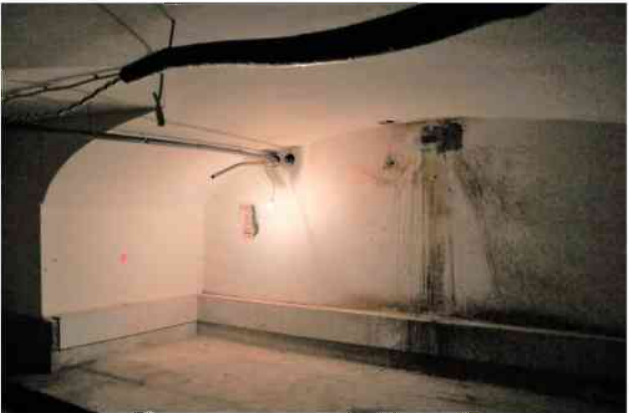
Фото п.255. Подвал, помещение 6Н (3).
