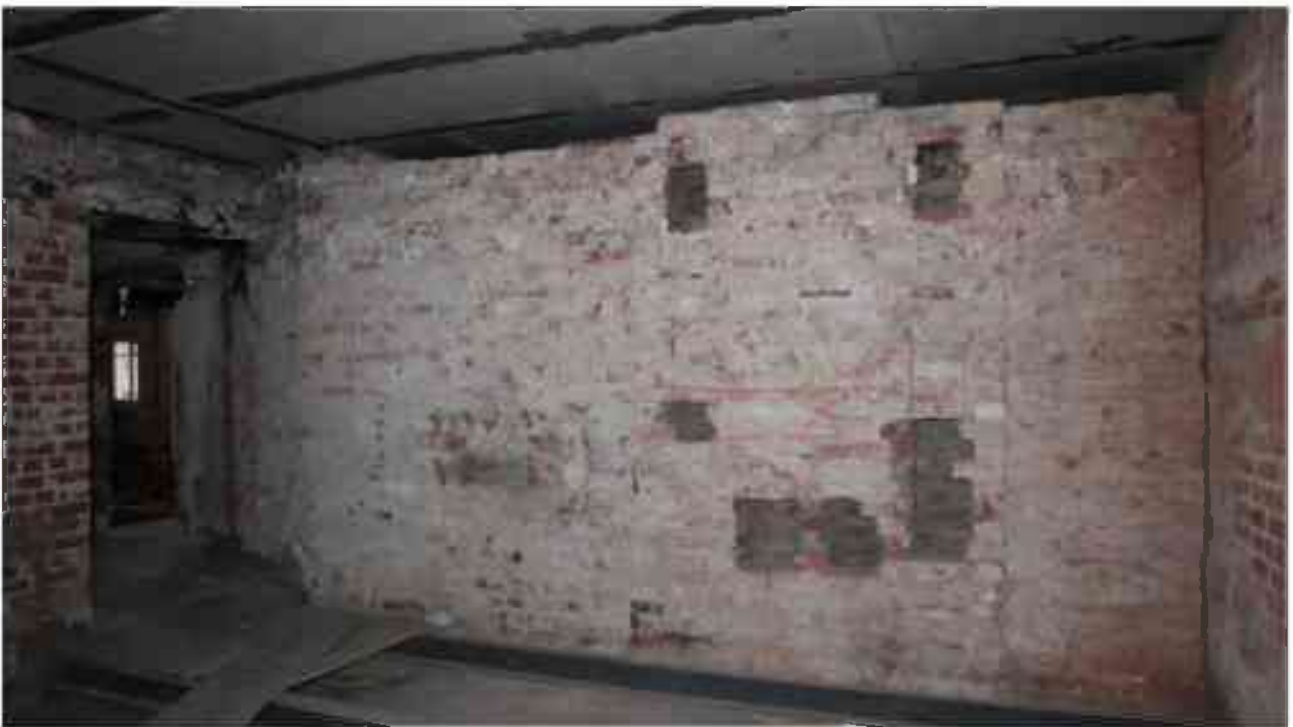
Фото 5.155. 5 этаж, жилой блок, на плане ПИБ 2000г. обозначен как квартиры, помещение (1-2).
