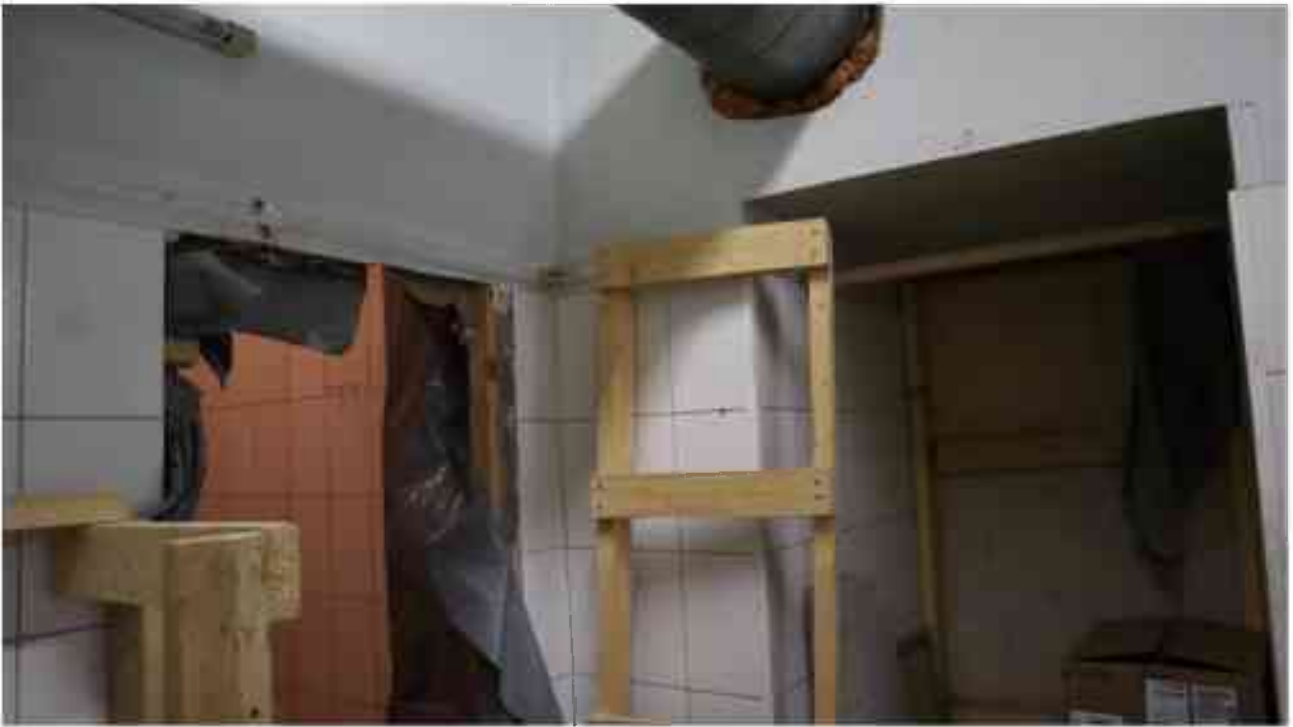
Фото 1.52. 1 этаж, помещение 14Н (2).
