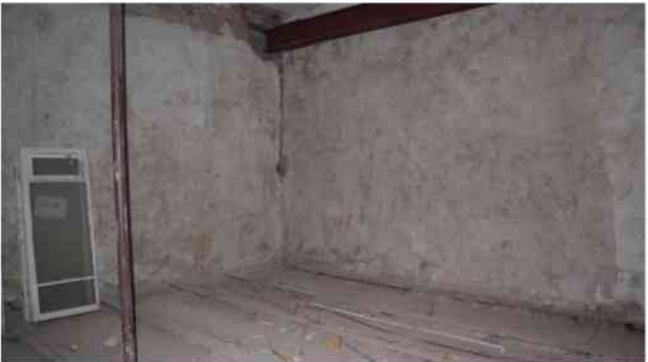
Фото 3.135. 3 этаж, помещение 26Н (2).
