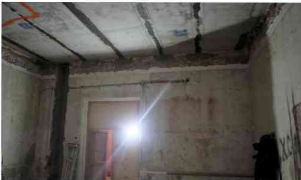
Фото 3.5. 3 этаж, помещение 28Н (36).
