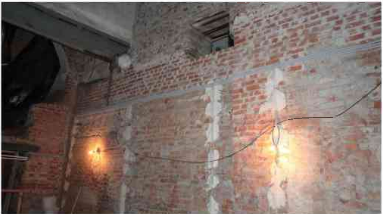
Фото п.56. Подвал, помещение 3Н (14).
