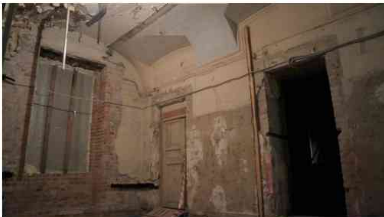
Фото 2.207. 2 этаж, помещение 22Н (1, 10).
