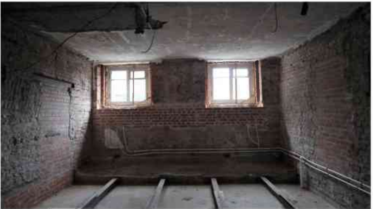
Фото 5.56. 5 этаж, помещение 35Н (8-11).
