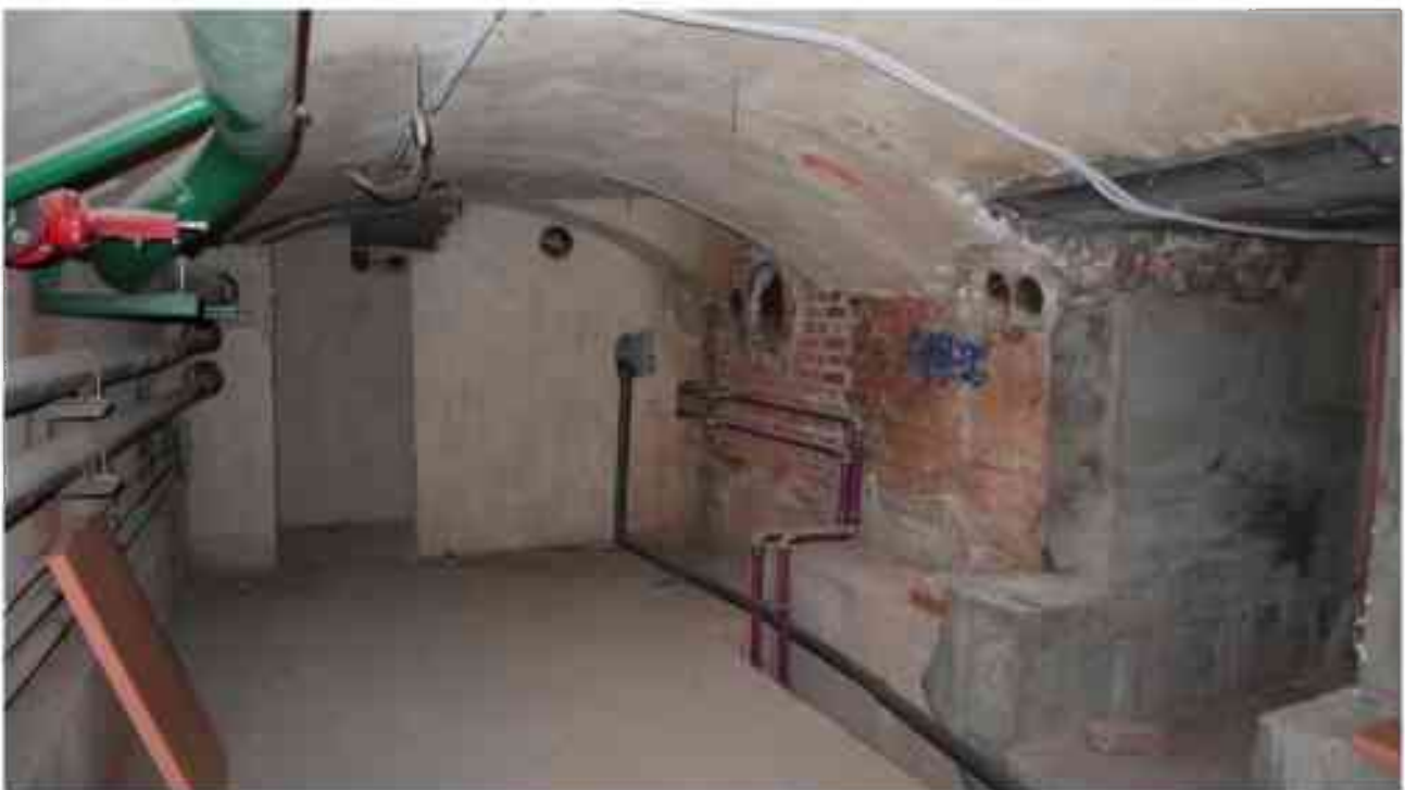
Фото п.189. Подвал, помещение 9Н (21).
