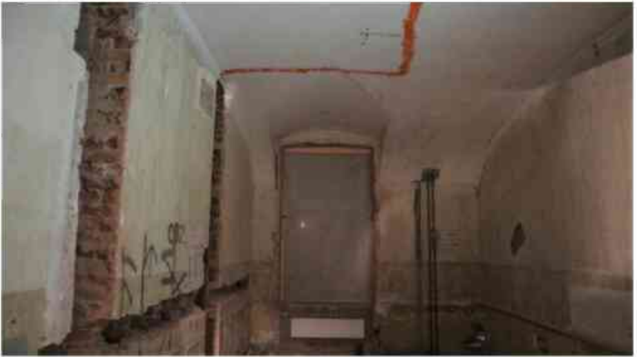
Фото 3.56. 3 этаж, помещение 28Н (14-17).
