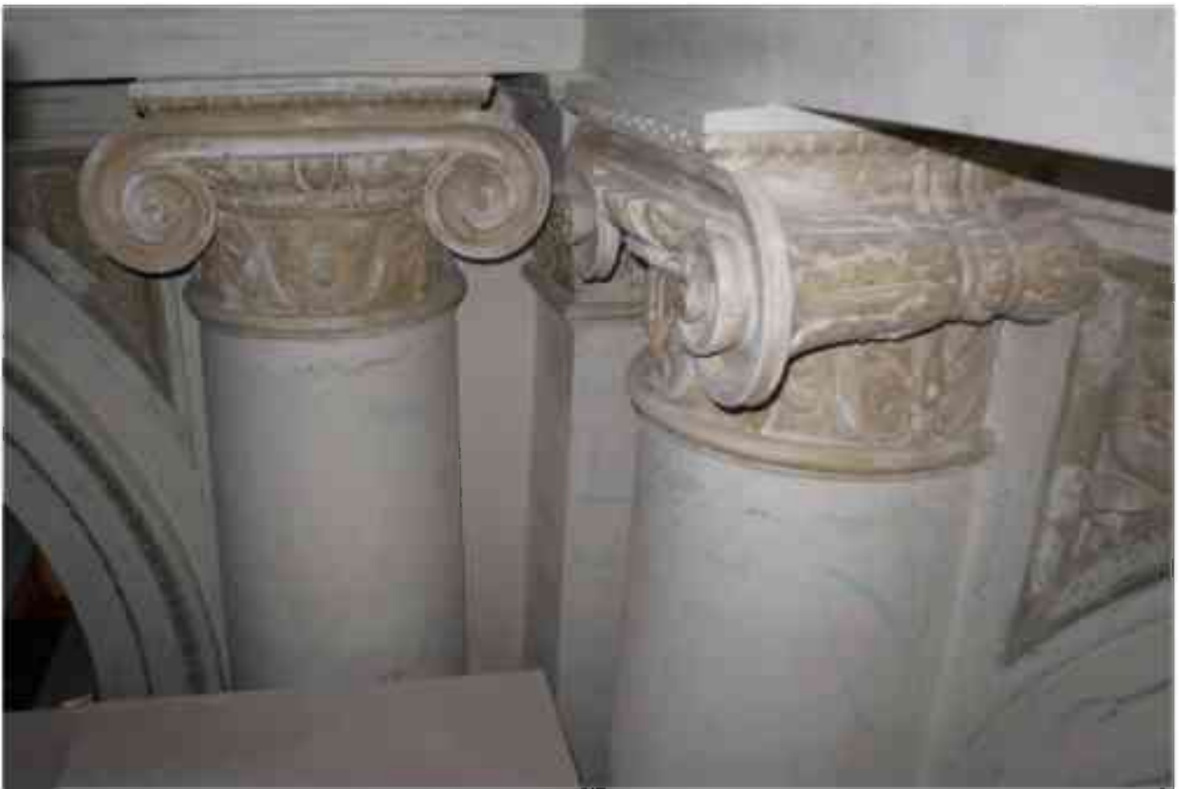
Фото 2.152. 2 этаж, помещение 22Н (19).*
