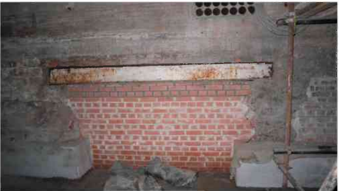
Фото п.317. Подвал, помещение 9Н (1).
