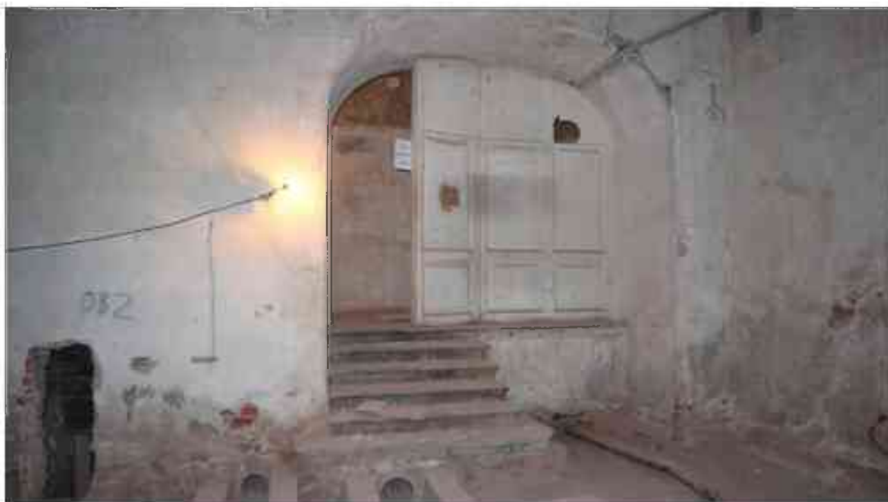
Фото 1.174. 1 этаж, помещение 31Н (18-19).
