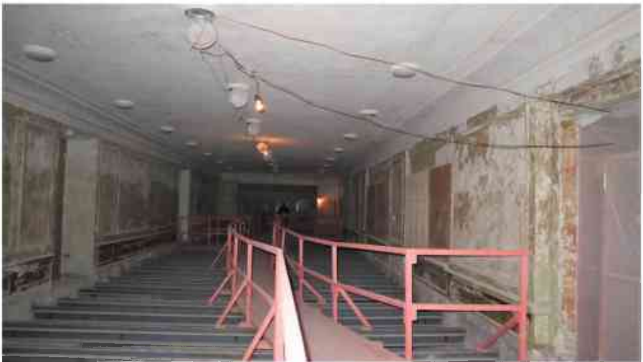
Фото 4.152. 4 этаж, помещение 30Н (5).
