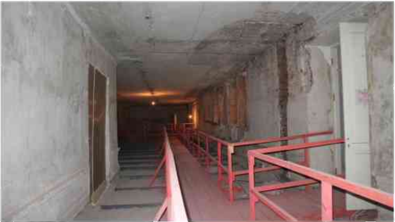
Фото 4.169. 4 этаж, помещение 30Н (7).
