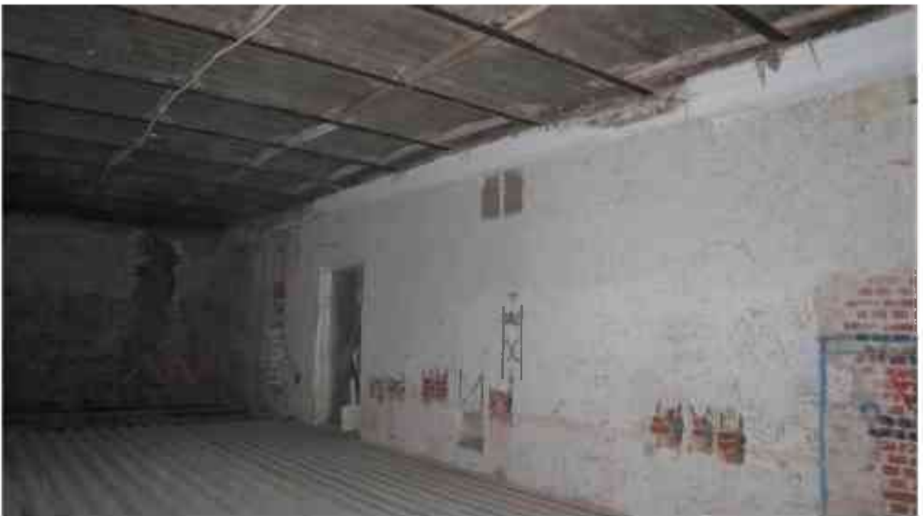
Фото 2.28. 2 этаж, помещение 22Н (68-72, 74-75).
