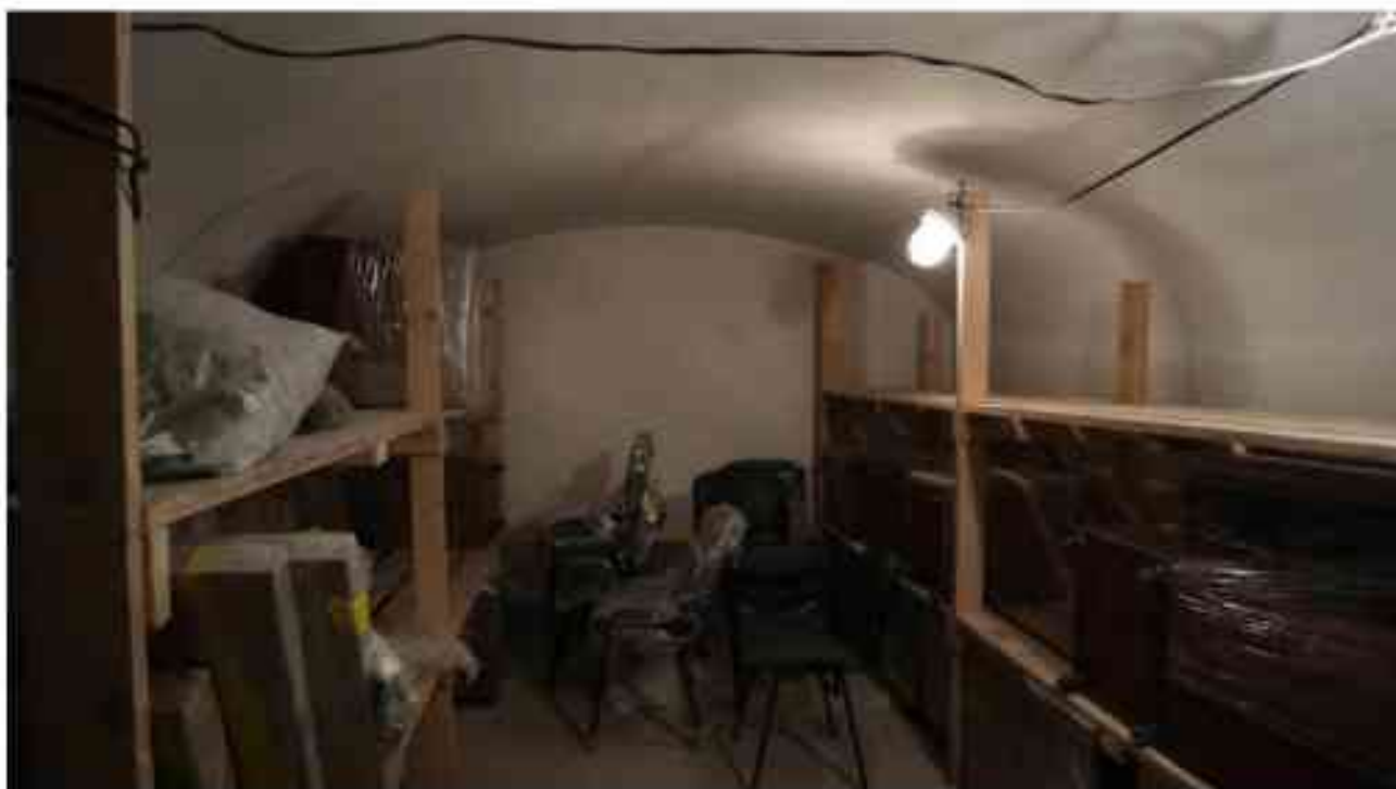
Фото п.132. Подвал, помещение 9Н (20).
