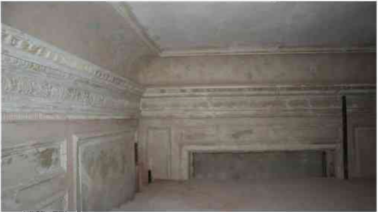
Фото 2.73. 2 этаж, помещение 22Н (31).*
