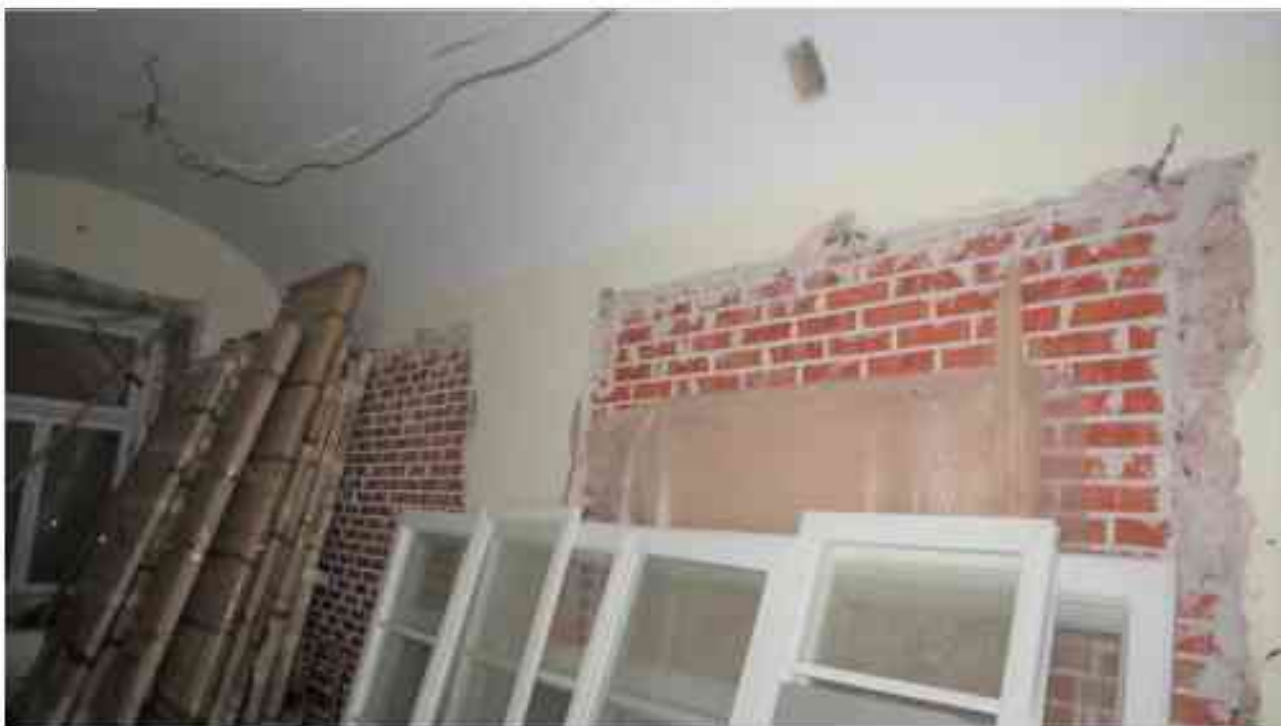
Фото 1.76. 1 этаж, помещение 14Н (25-26).
