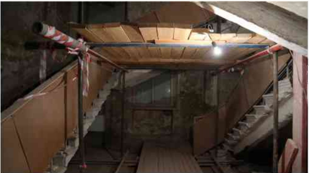
Фото 1.318. 1 этаж, лестница в ризалите южного фасада (западная часть).
