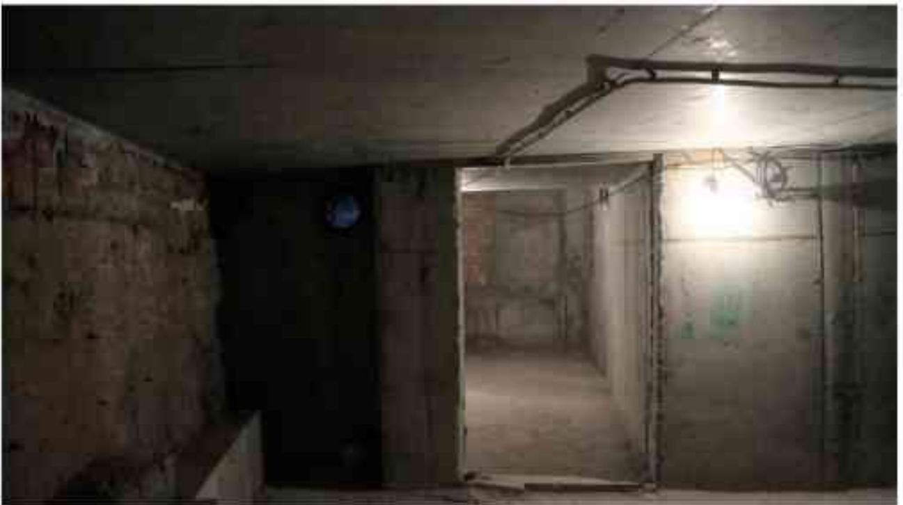
Фото п.46. Подвал, помещение 3Н (12).
