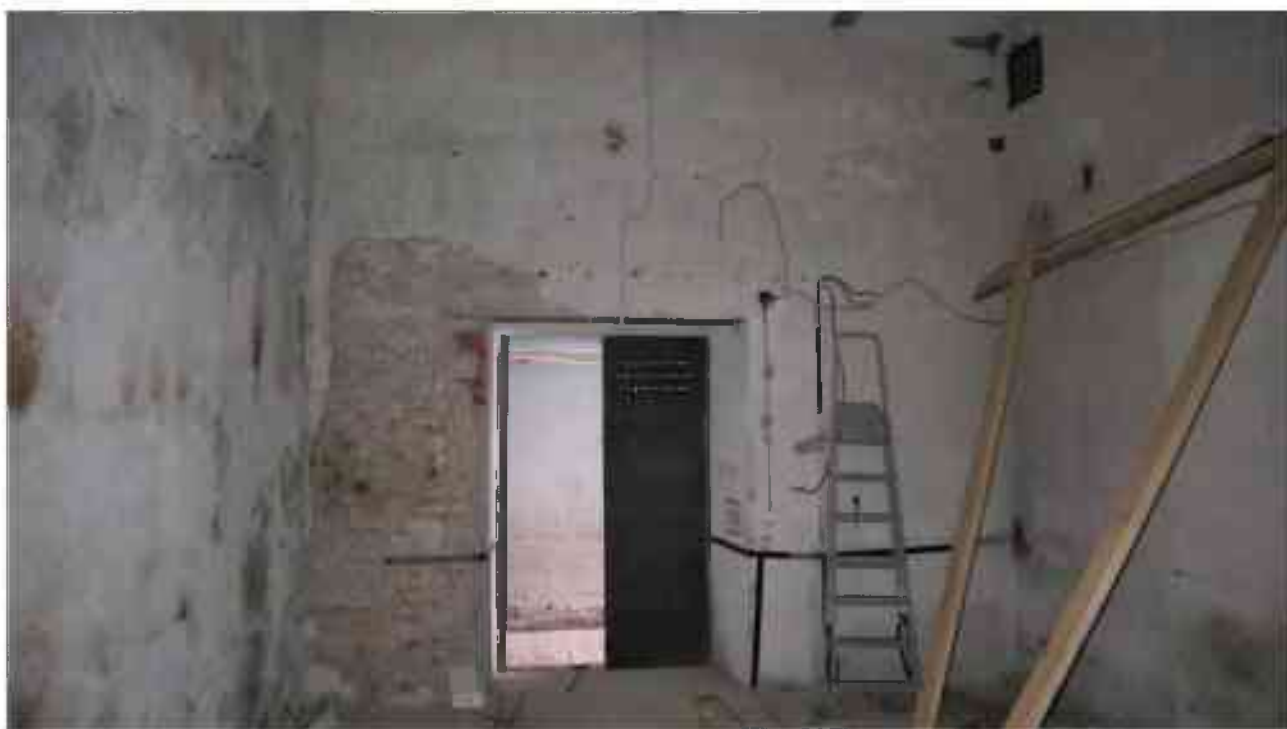
Фото 1.327. 1 этаж, помещение 16Н (1).
