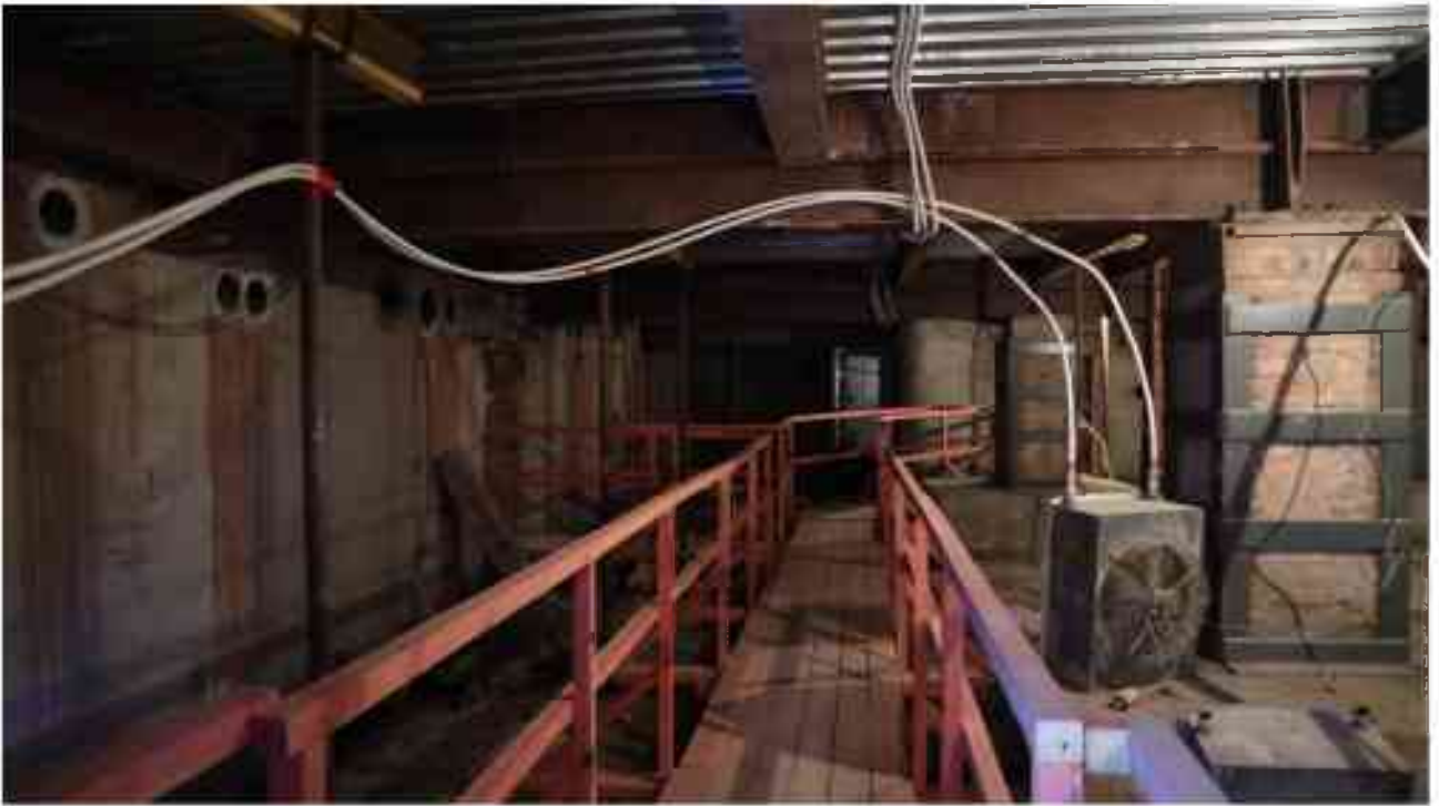
Фото п.26. Подвал, помещение 3Н (5).
