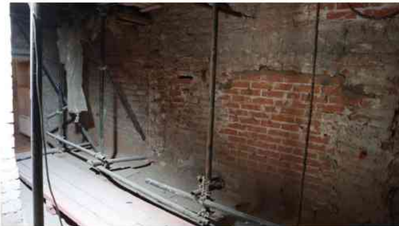
Фото 1.182. 1 этаж, помещение 17Н (1).
