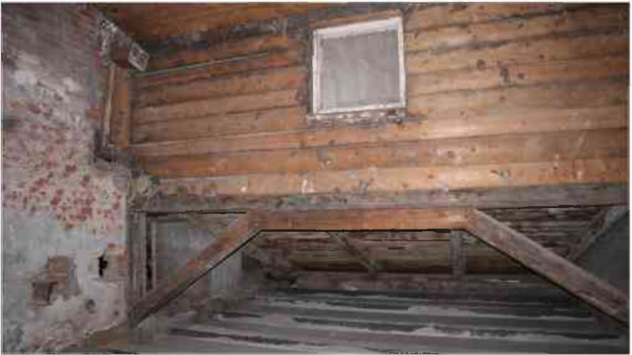
Фото 6.58. 6 этаж, чердачное помещение.
