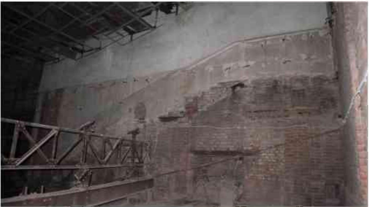
Фото 4.199. 4 этаж, помещение 30Н (3).
