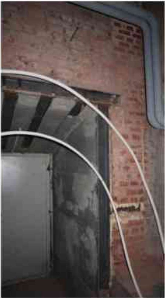
Фото п.45. Подвал, помещение 3Н (12).
