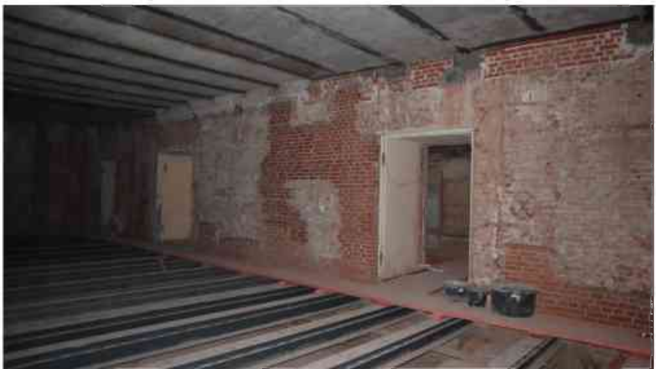
Фото 4.60. 4 этаж, помещение 33Н (47-49).
