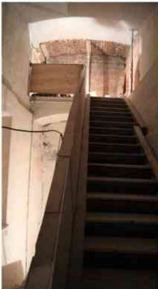
Фото 5.197. 5 этаж, лестница Л-20.
