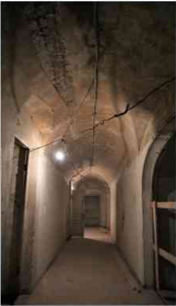
Фото 1.152. 1 этаж, помещение 31Н (15).
