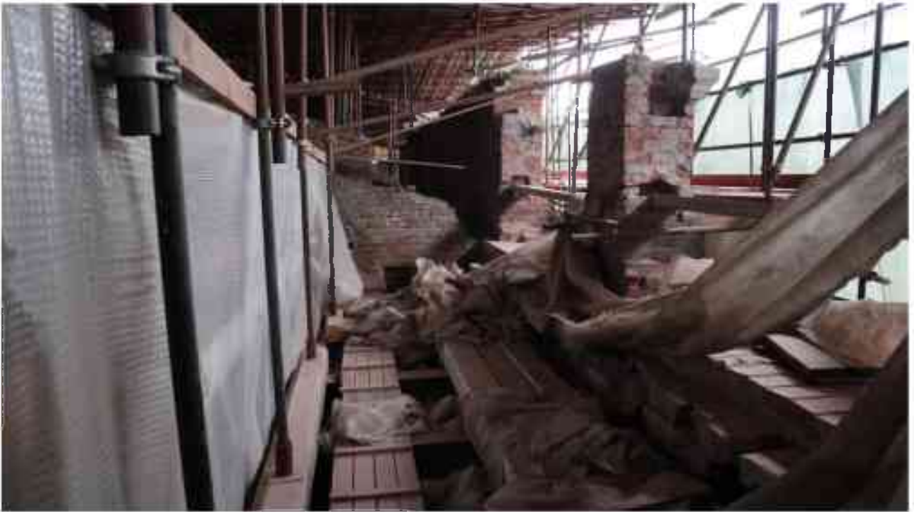
Фото 5.168. 5 этаж, чердачное помещение.
