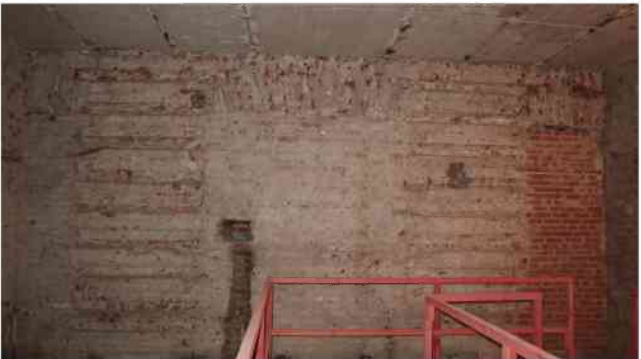
Фото 1.230. 1 этаж, помещение 15Н (4).
