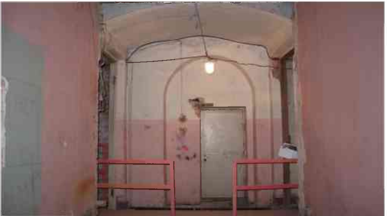
Фото 4.98. 4 этаж, помещение 36Н (6, 4).
