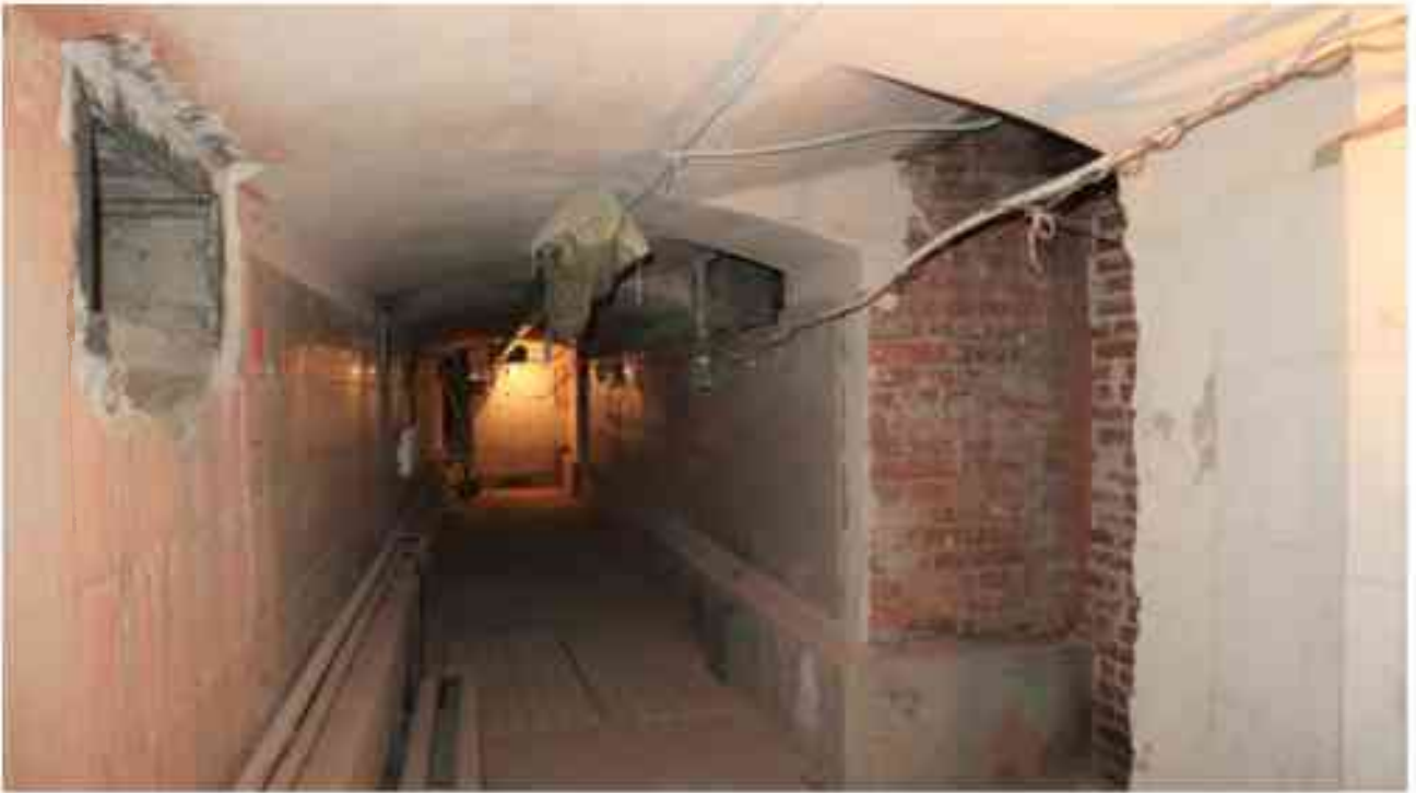
Фото п.278. Подвал, помещение 6Н (8).
