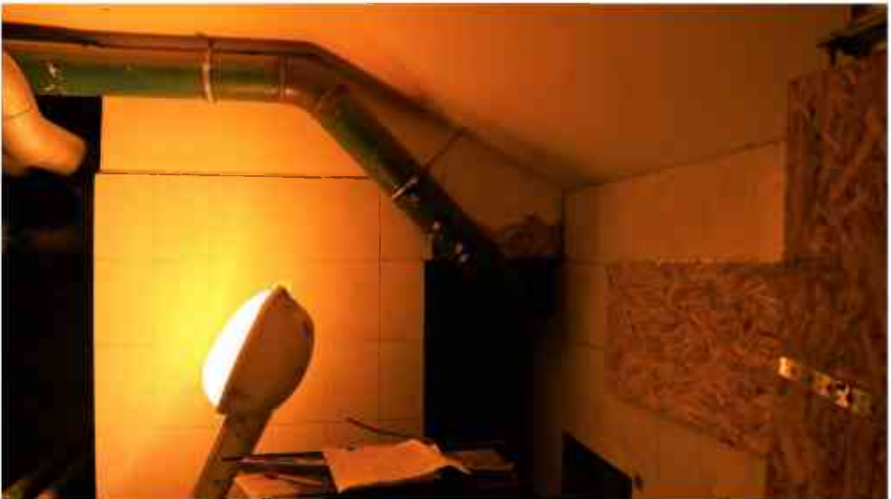
Фото п.304. Подвал, помещение 3Н (16).
