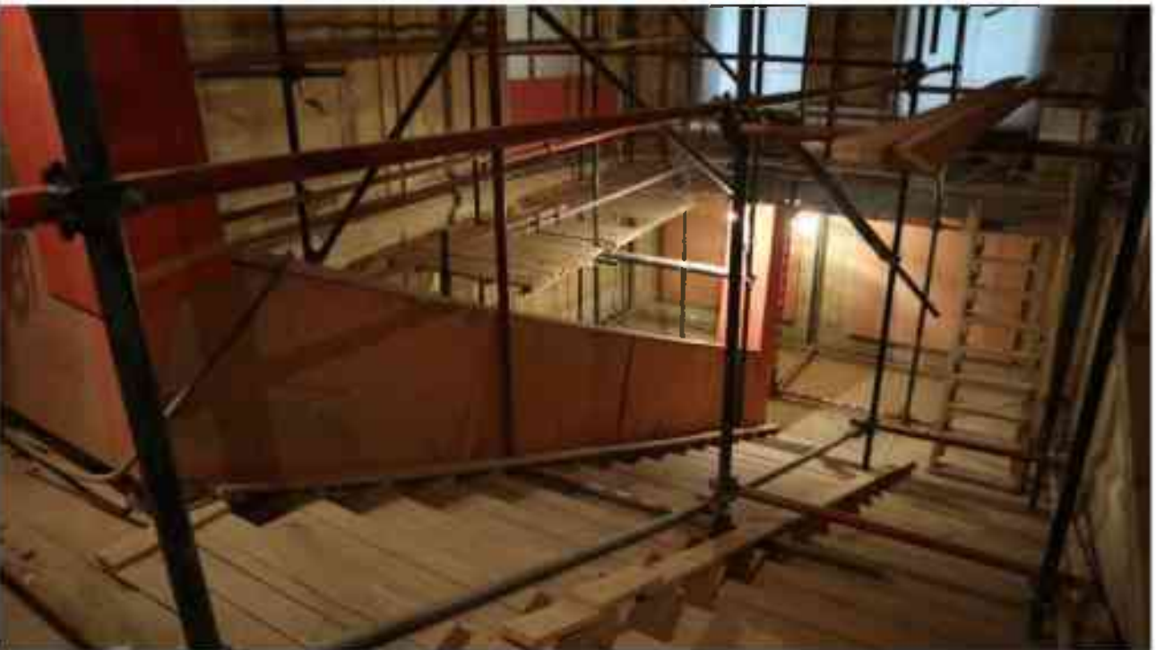
Фото 3.62. 3 этаж, лестница Л-14.
