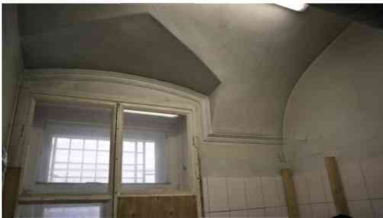
Фото 1.51. 1 этаж, помещение 14Н (2).
