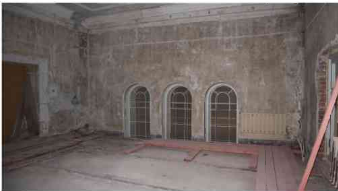
Фото 4.12. 4 этаж, помещение 33Н (38).
