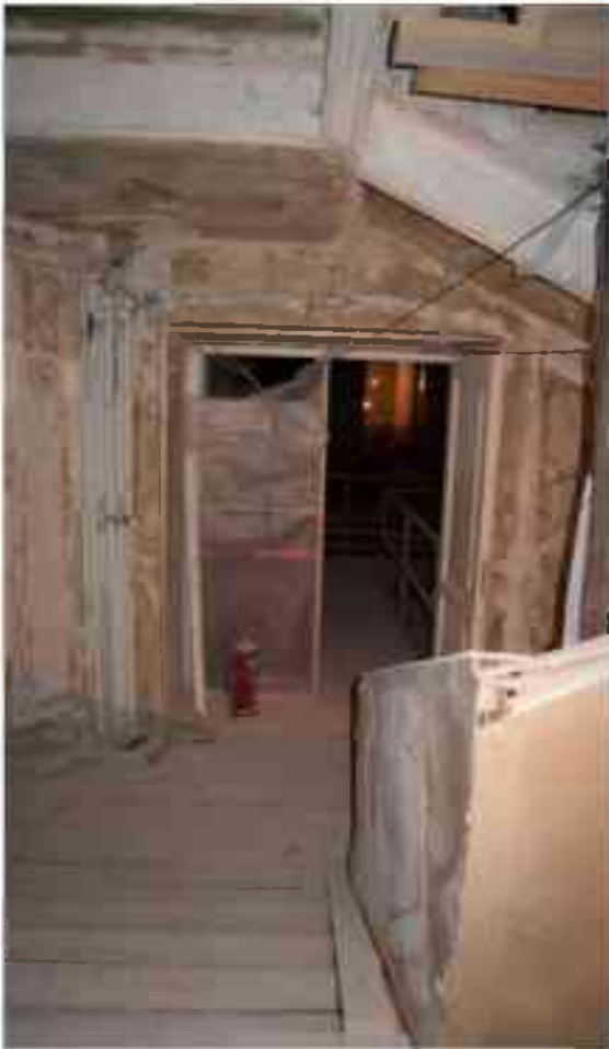
Фото 2.166. 2 этаж, лестница Л-10.
