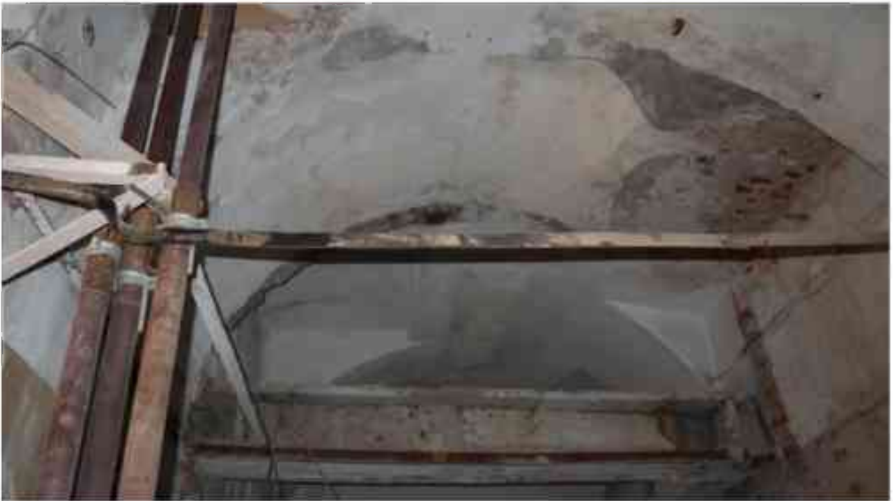
Фото 2.239. 2 этаж, помещение 22Н (58, 81).
