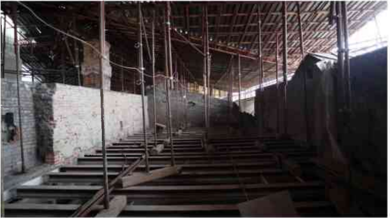
Фото 5.176. 5 этаж, чердачное помещение.
