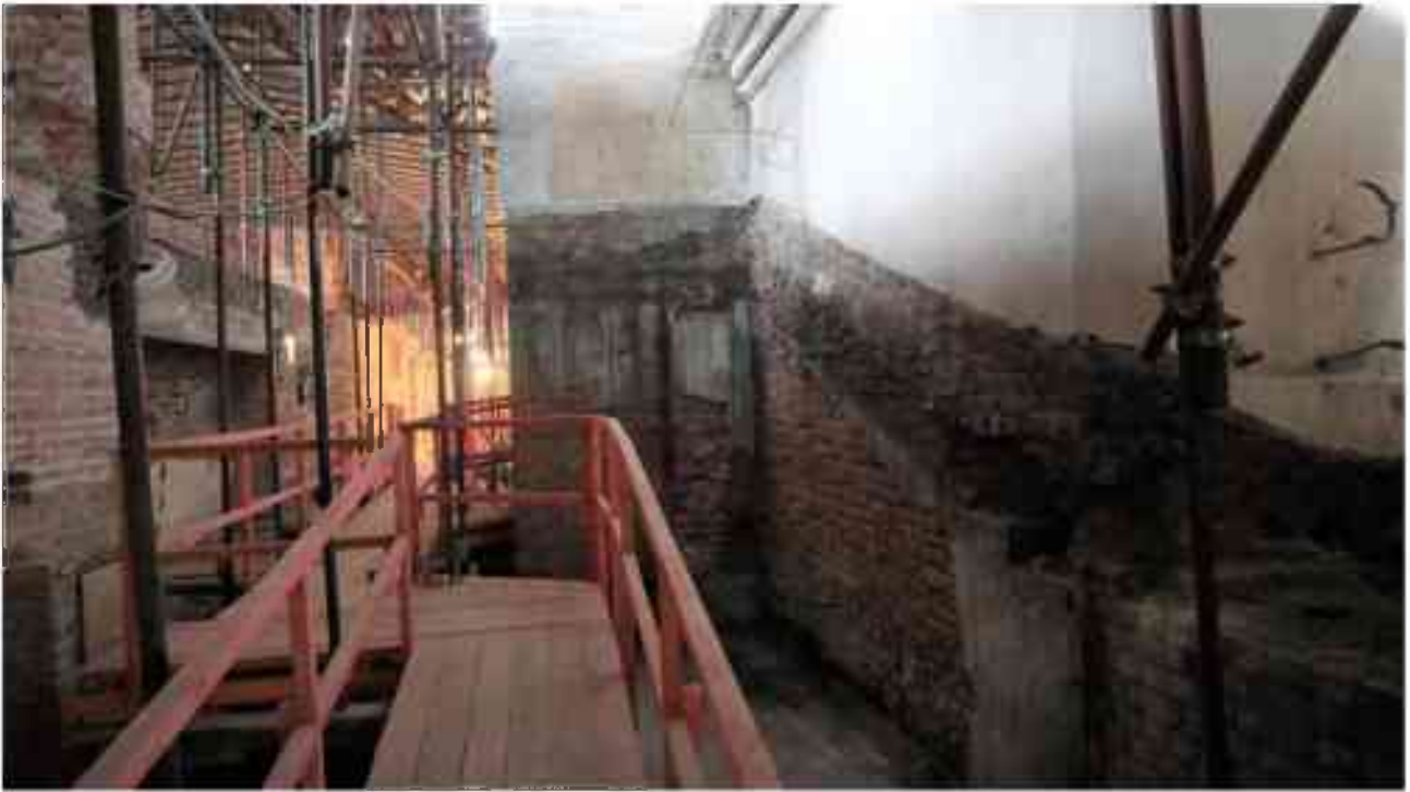
Фото 5.130. 5 этаж, коридор, помещения 34Н/37Н.
