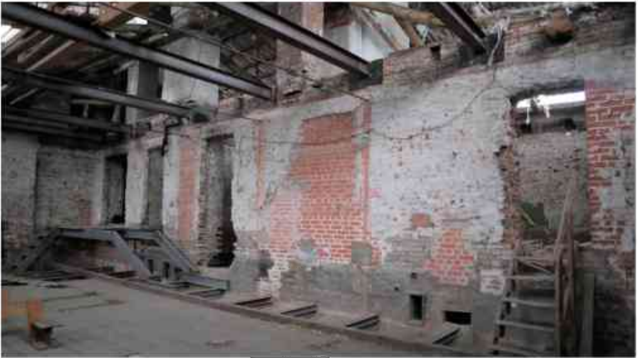
Фото 5.144. 5 этаж, жилой блок, на плане ПИБ 2000г. обозначен как квартиры, помещение (9-19).
