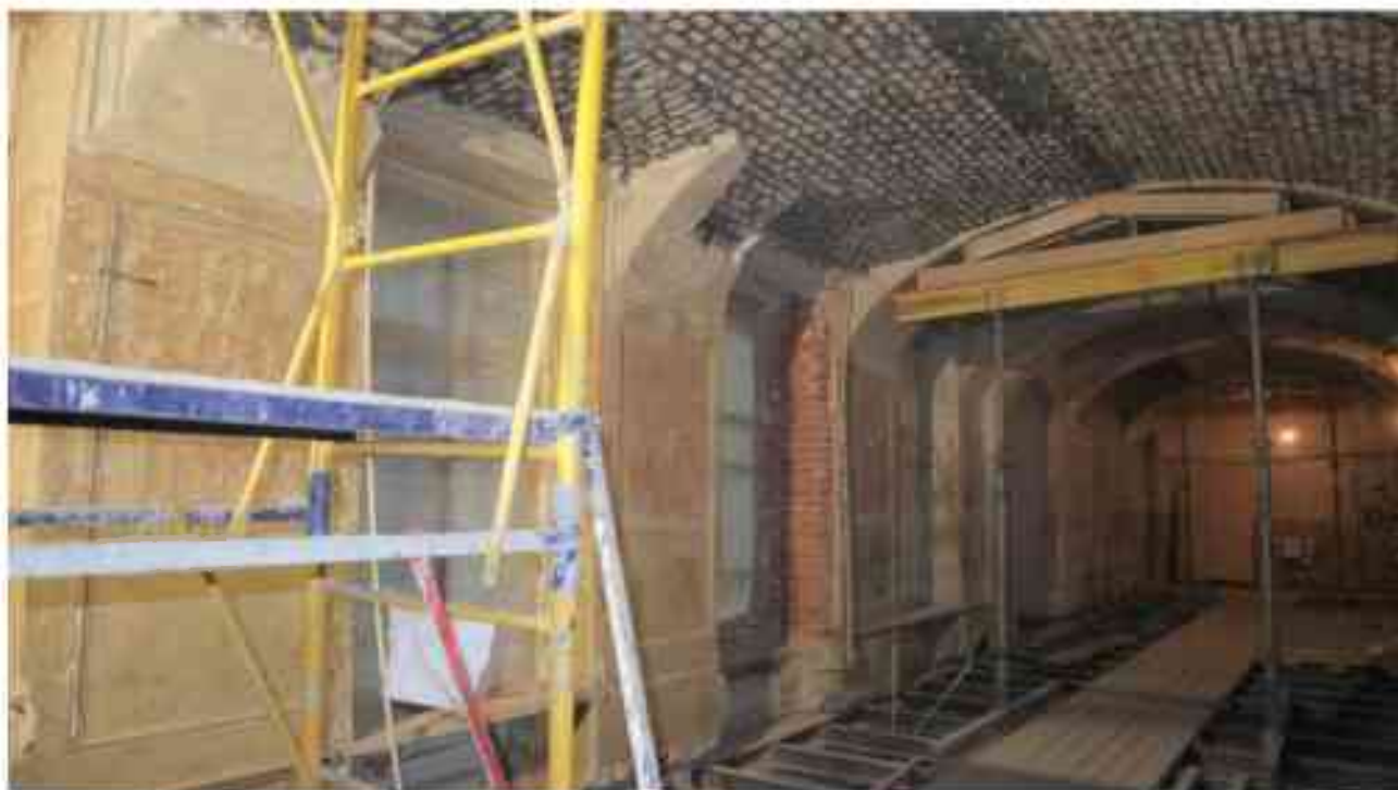
Фото 3.38. 3 этаж, помещение 28Н (11).
