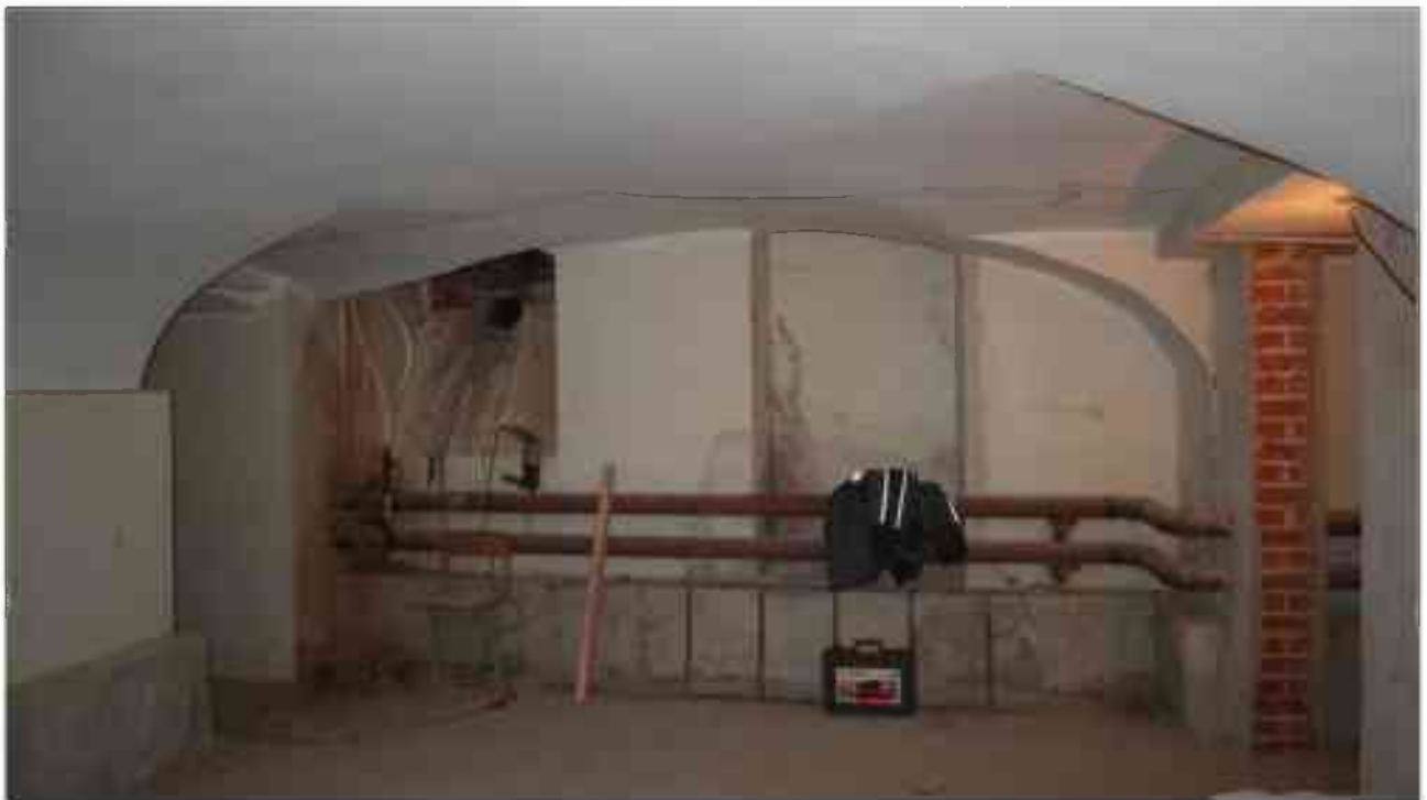
Фото п.87. Подвал, помещение 8Н (5).
