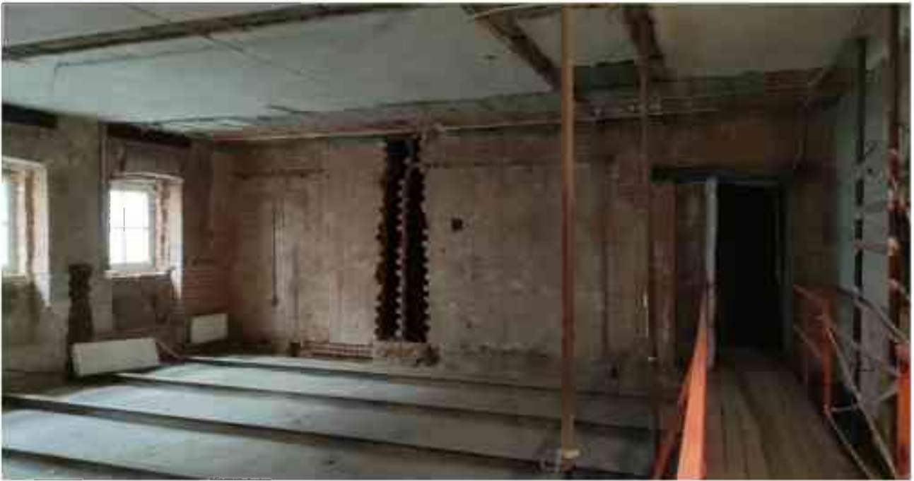
Фото 5.92. 5 этаж, помещение 34Н(3-11).
