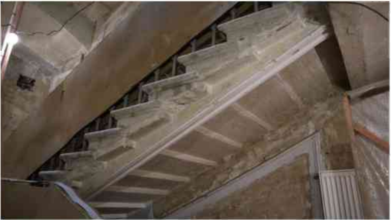
Фото 1.26. 1 этаж, лестница Л-1.
