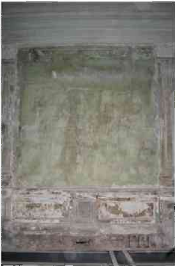
Фото 2.159. 2 этаж, помещение 22Н (20).
