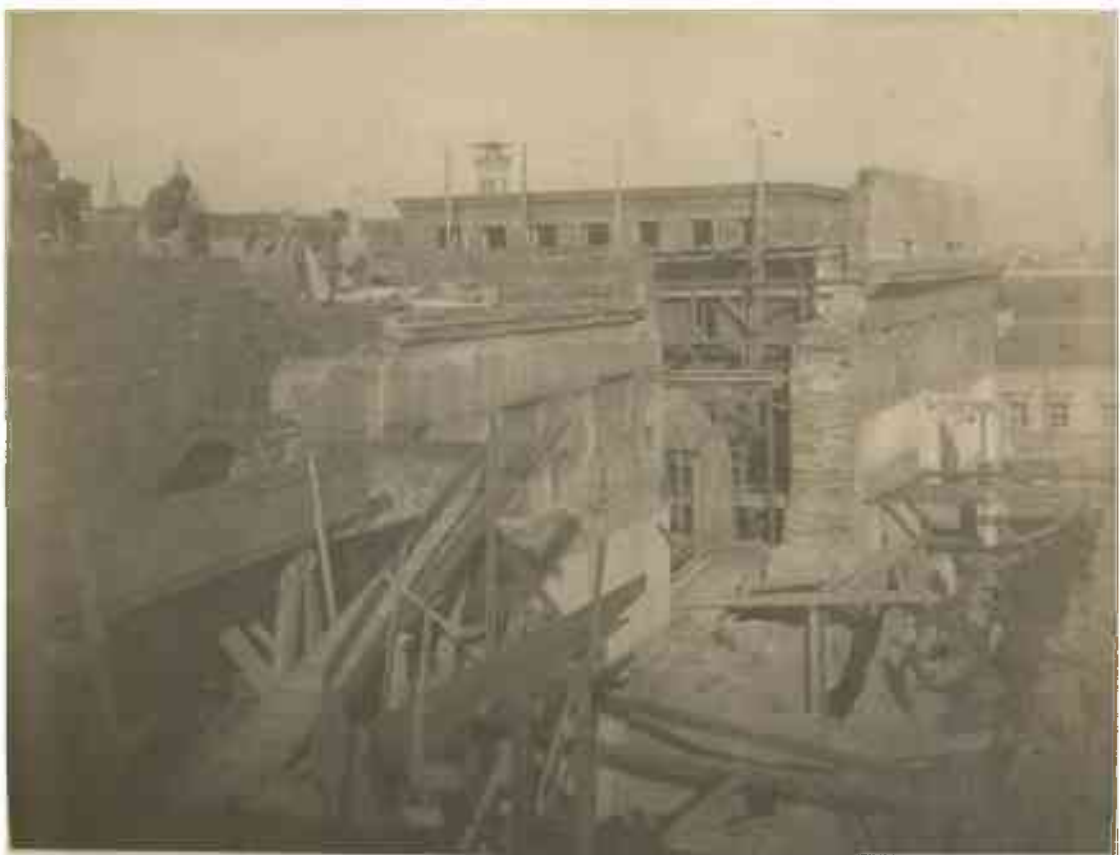
Ил. 110. Перестройка здания Большого театра под Консерваторию. Фото. 1891-1893 гг. РГИА. Ф.1293. Оп.167. Д.142. Л. 11. (Фото 20).
