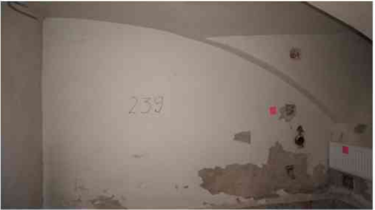
Фото п.214. Подвал, помещение 9Н (4).
