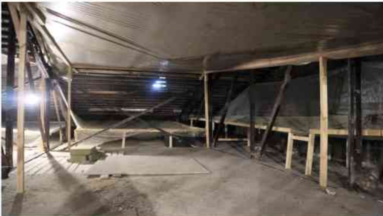
Фото 5.114. Чердак уровня 5 этажа.
