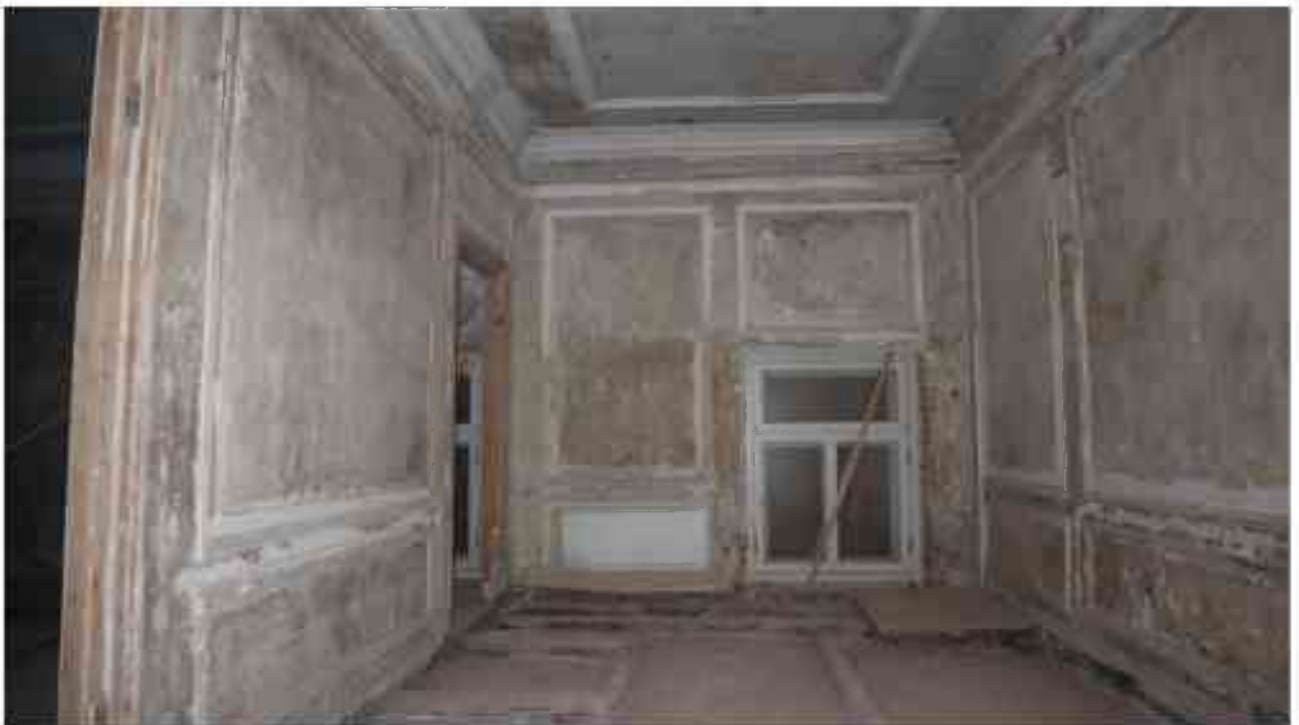
Фото 4.5. 4 этаж, помещение 33Н (39).
