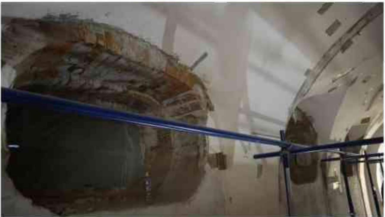
Фото 3.53. 3 этаж, помещение 28Н (20-21).*
