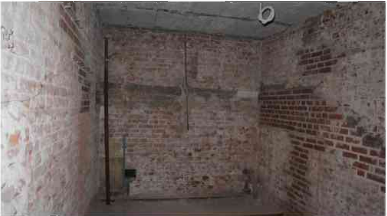
Фото 5.87. 5 этаж, помещение 34Н(12).
