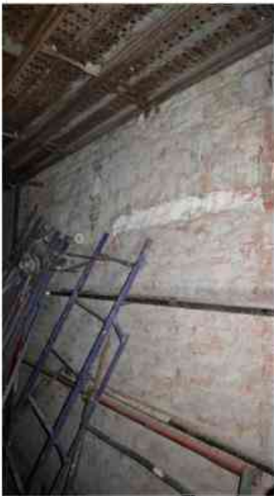
Фото 1.96. 1 этаж, помещение 14Н (43-44).
