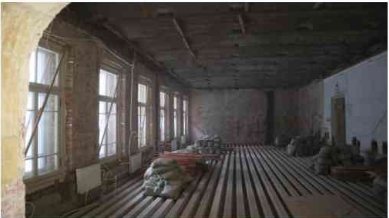
Фото 3.28. 3 этаж, помещение 28Н (29-35).
