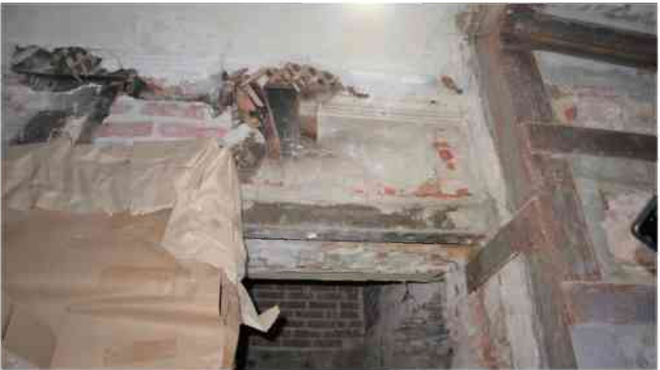
Фото 1.31. 1 этаж, помещение 14Н (16).
