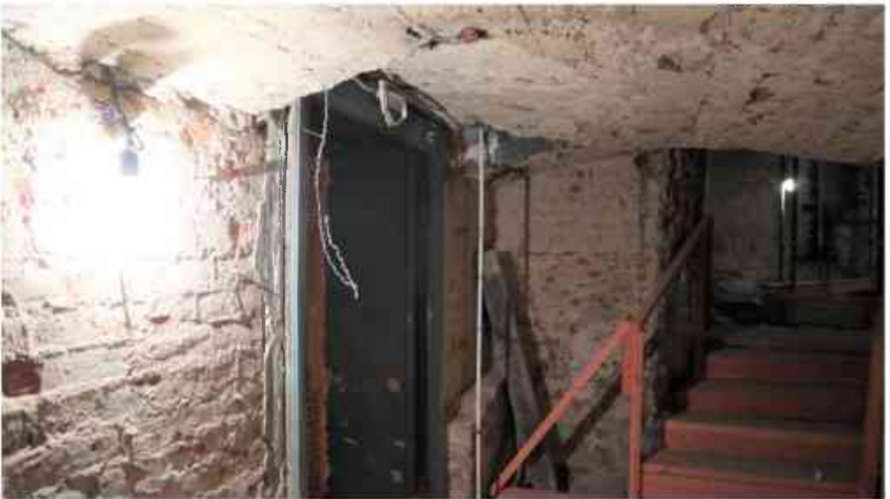
Фото 1.159. 1 этаж, помещение 10Н (1-3).
