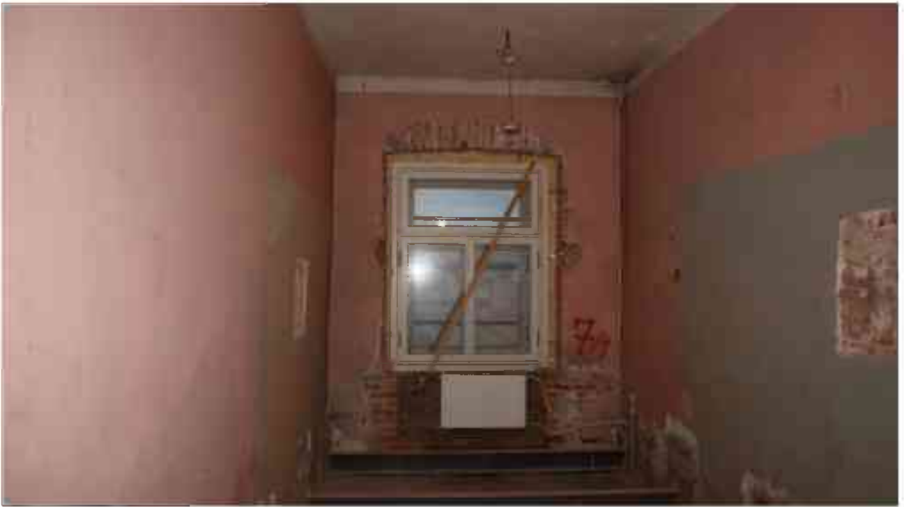
Фото 4.97. 4 этаж, помещение 36Н (6).
