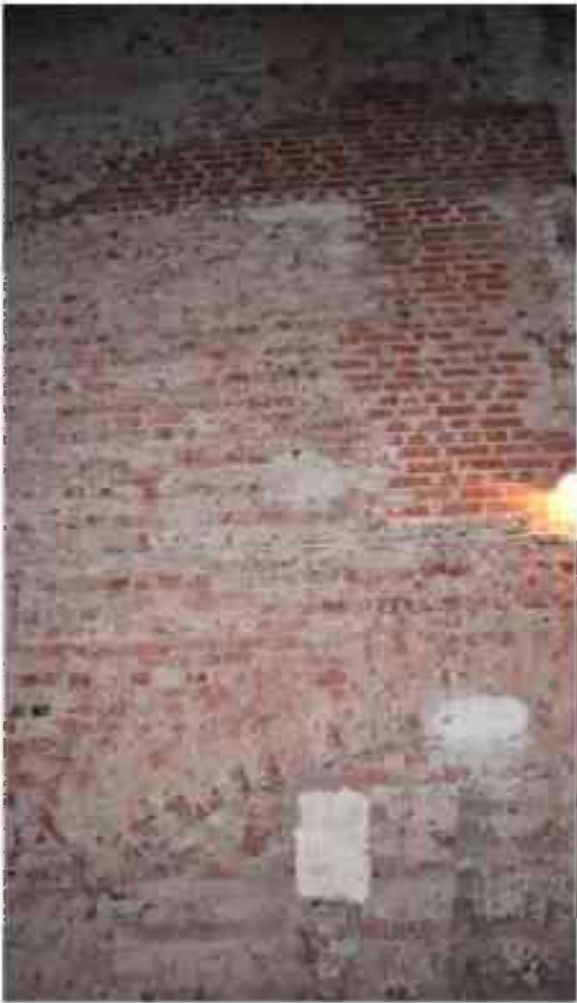
Фото п.53. Подвал, помещение 3Н (14).
