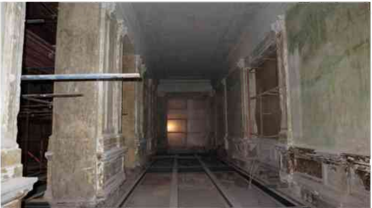
Фото 2.162. 2 этаж, помещение 22Н (20).
