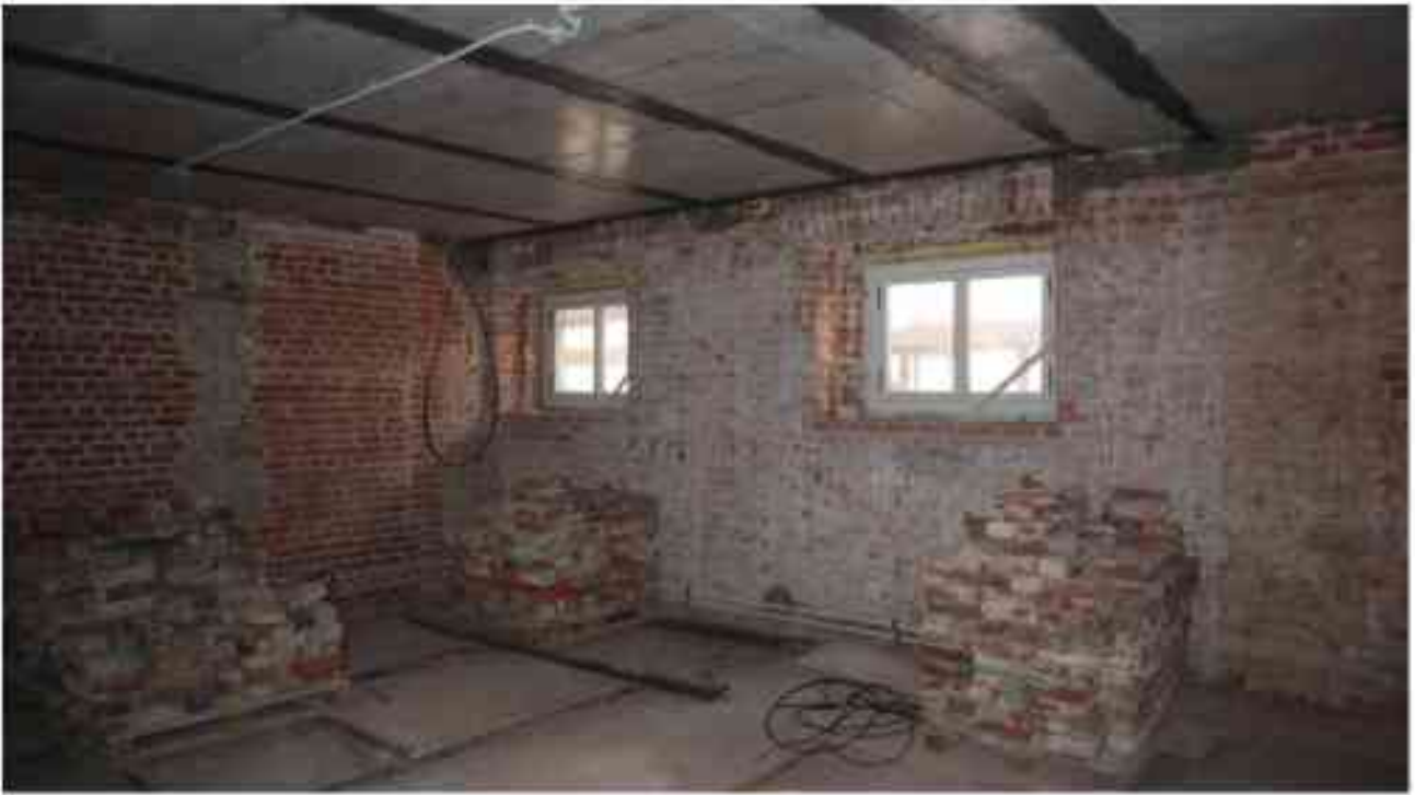
Фото 5.24. 5 этаж, помещение 37Н (9).
