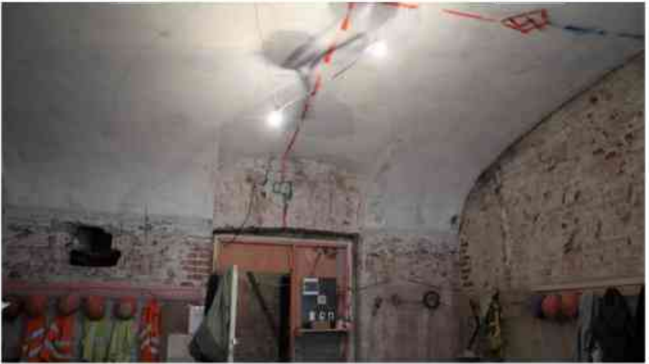
Фото 2.112. 2 этаж, помещение 22Н (55).
