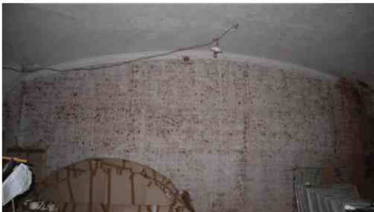
Фото 1.116. 1 этаж, помещение 14Н (30-34).
