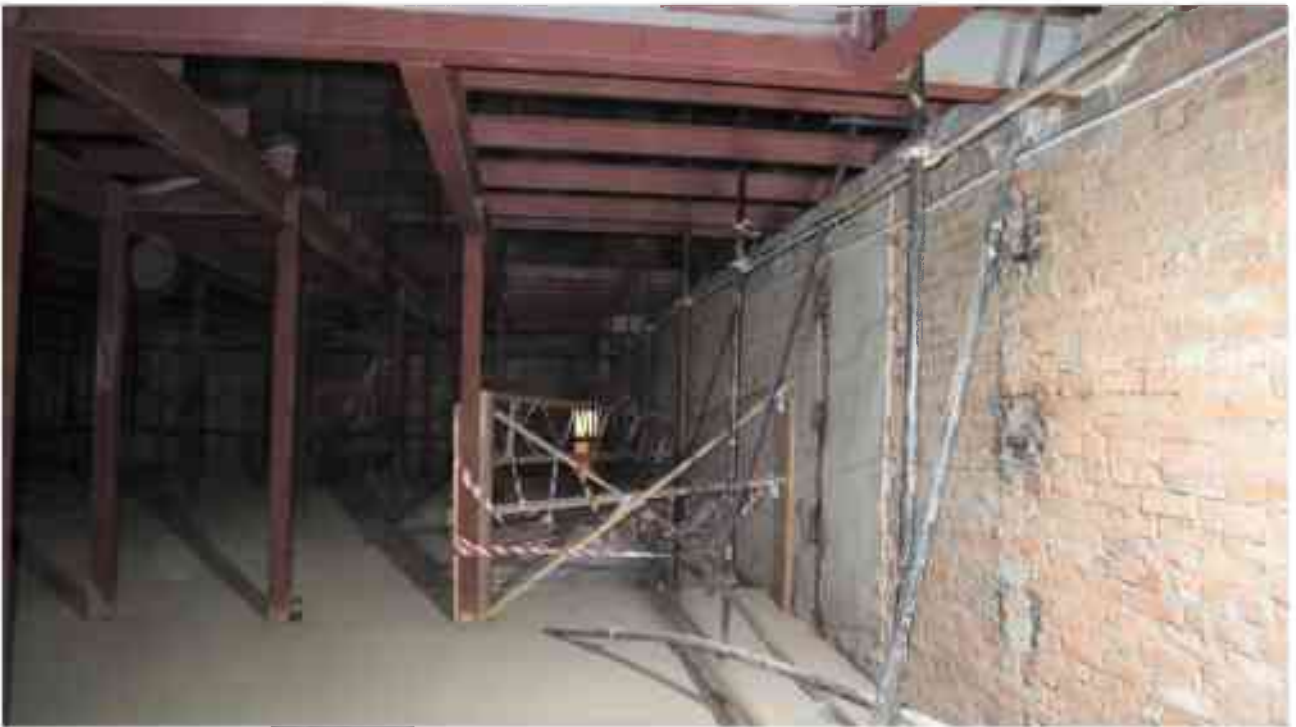
Фото 1.185. 1 этаж, помещение 17Н (1).
