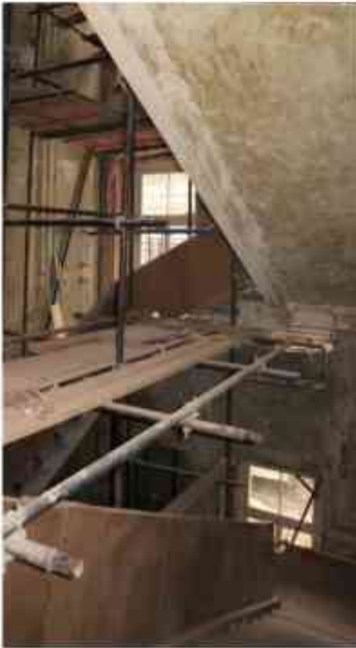
Фото 3.132. 3 этаж, лестница с перекрестными маршами, трехмаршевая, в центре здания.*
