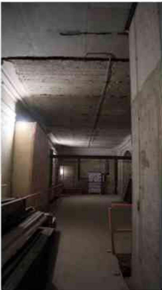
Фото 1.309. 1 этаж, помещение 13Н (1, 5).
