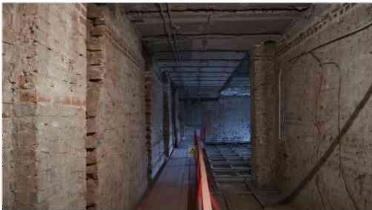
Фото 5.50. 5 этаж, помещение 35Н (12-14).
