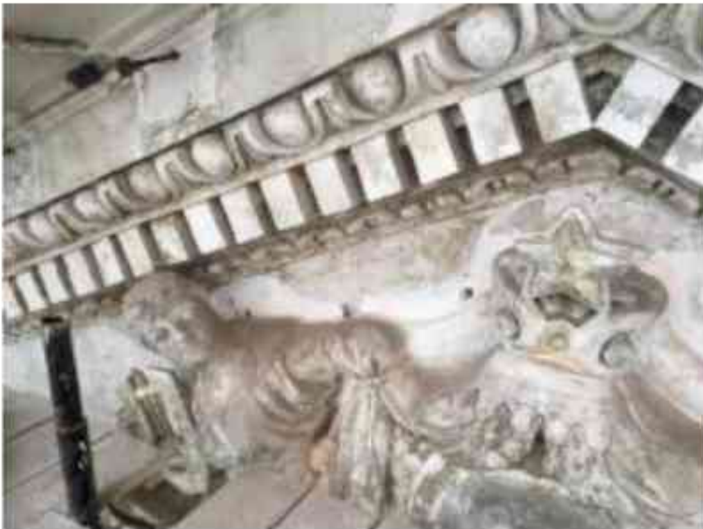
267. Фрагмент тимпана фронтона южного фасада. Фото 2019 г.
