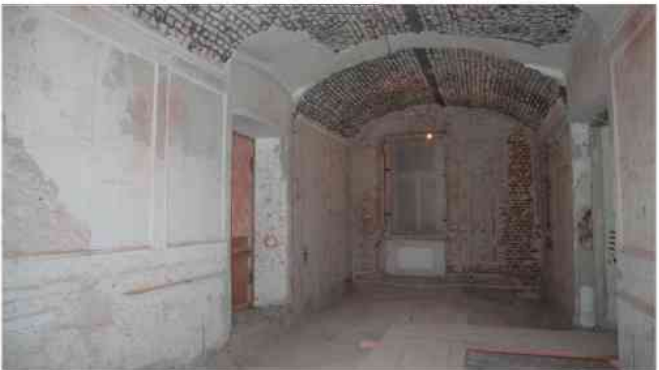
Фото 2.2. 2 этаж, помещение 22Н (41).
