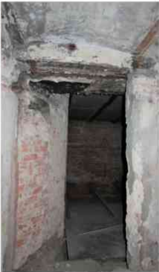
Фото 5.151. 5 этаж, жилой блок, на плане ПИБ 2000г. обозначен как квартиры, помещение (3).
