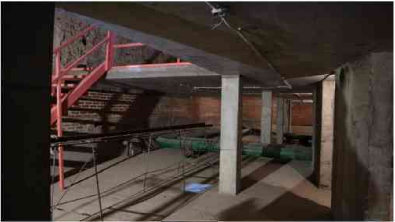
Фото п.36. Подвал, помещение 3Н (12).
