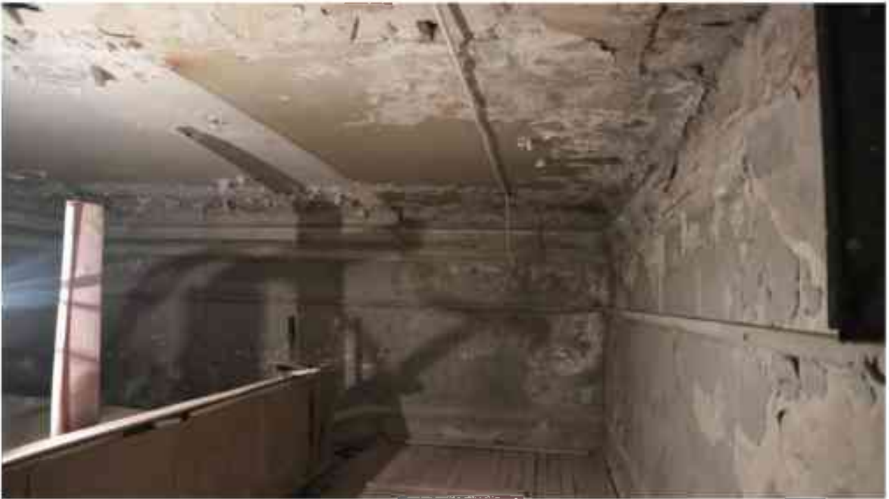
Фото 5.106. 5 этаж, лестница в ризалите южного фасада (западная часть).*
