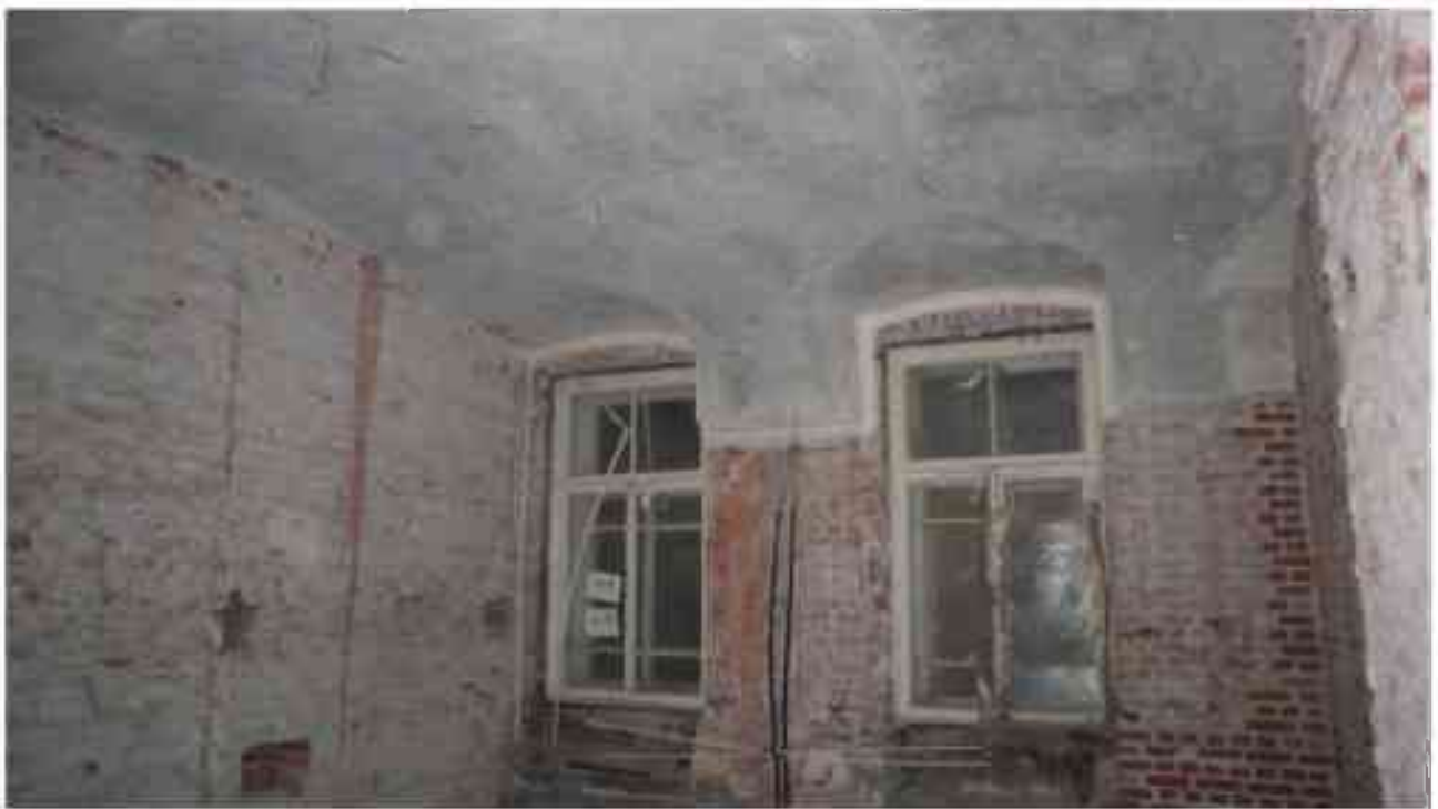
Фото 2.32. 2 этаж, помещение 22Н (73).
