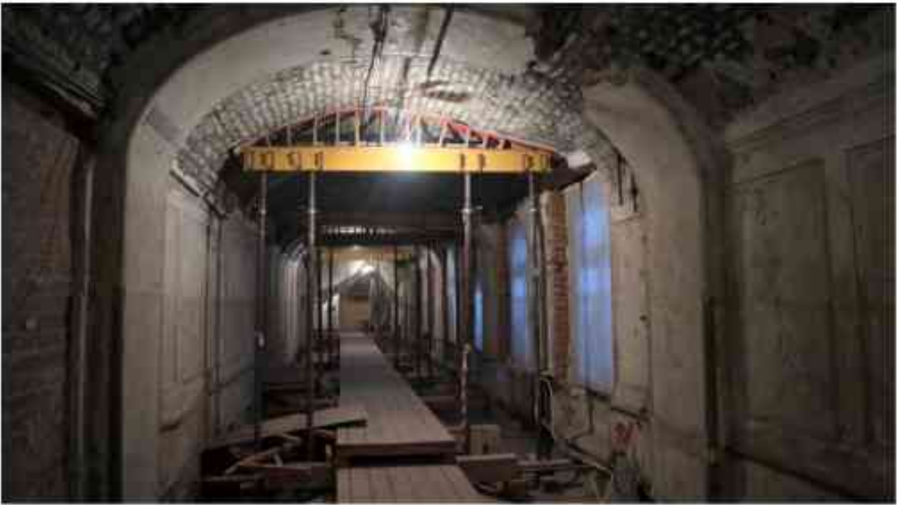
Фото 4.57. 4 этаж, коридор, помещение 33Н (22).
