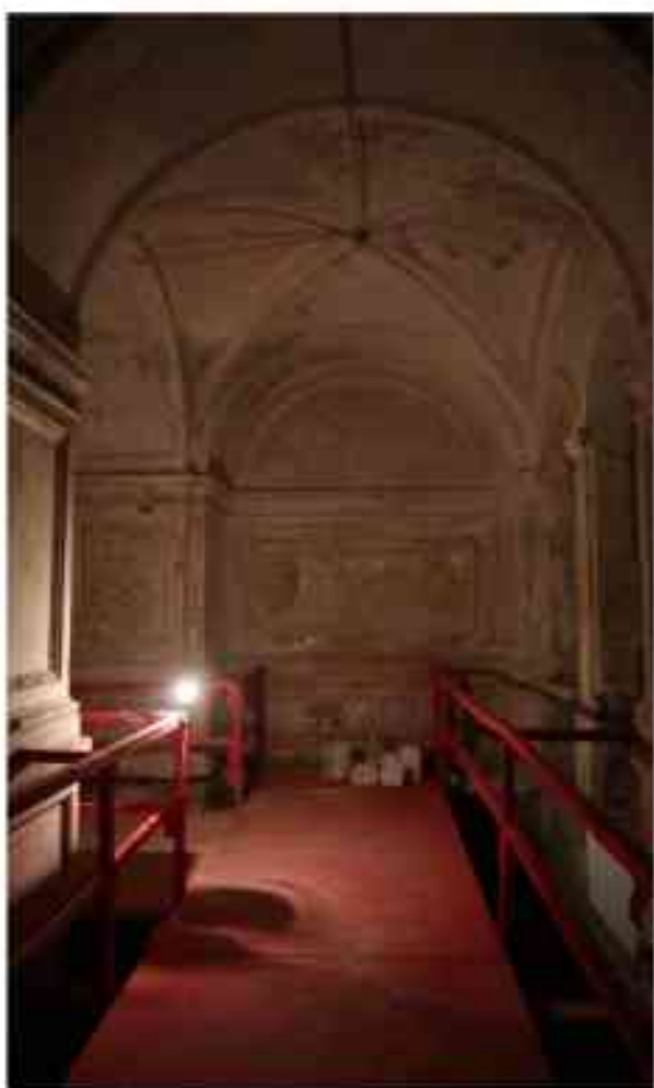
Фото 4.160. 4 этаж, помещение 30Н (4).
