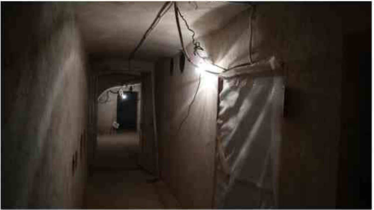
Фото п.7. Подвал, помещение 2Н (1).
