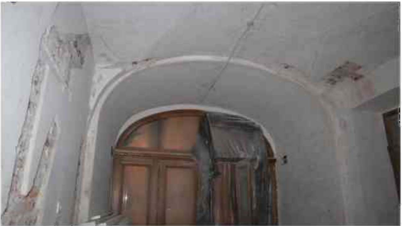
Фото 1.98. 1 этаж, лестница Л-4.
