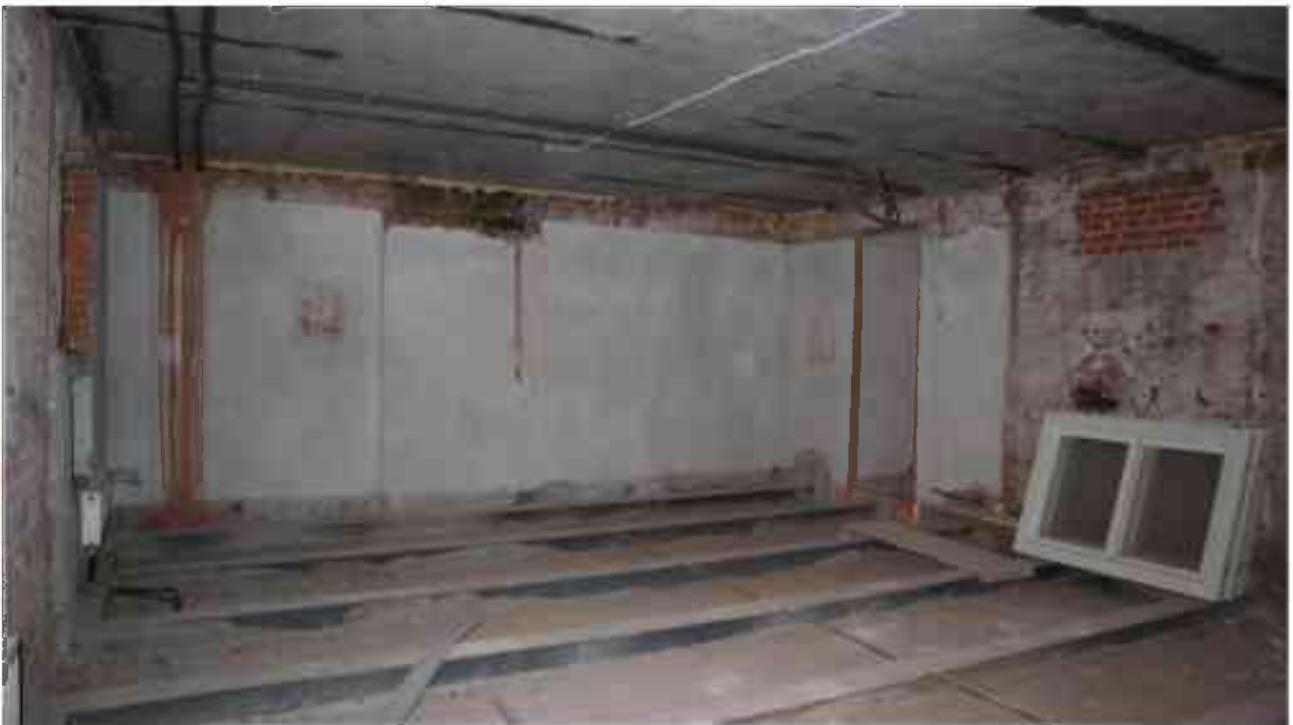
Фото 5.23. 5 этаж, помещение 37Н (6-8).
