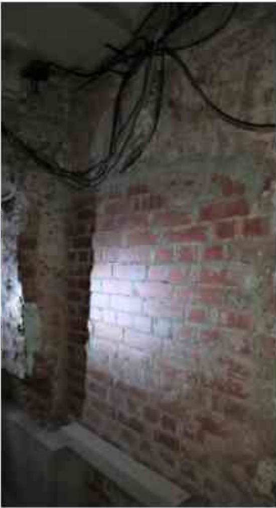
Фото п.184. Подвал, помещение 9Н (6), лестница Л-16.
