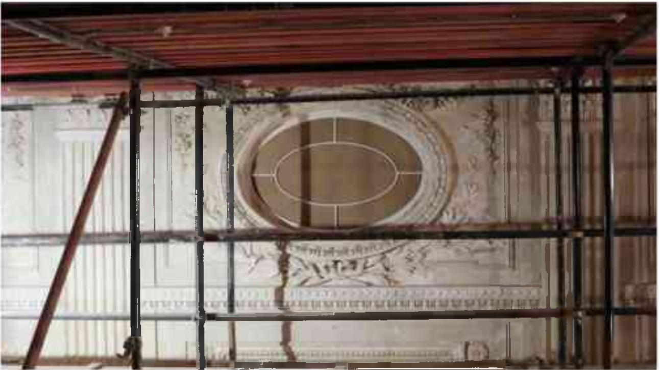
Фото 3.83. 3 этаж, помещение 28Н (2).*
