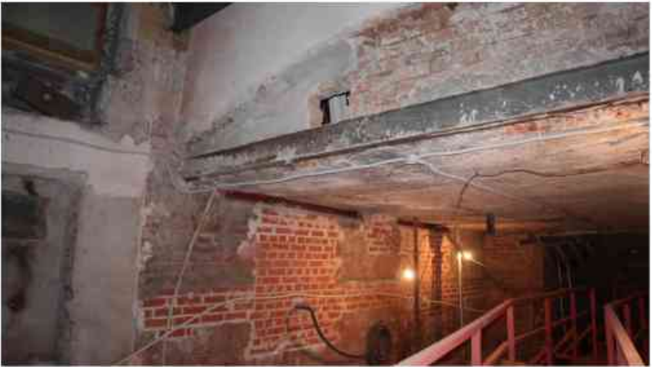
Фото п.336. Подвал, помещение 18Н (3-4).
