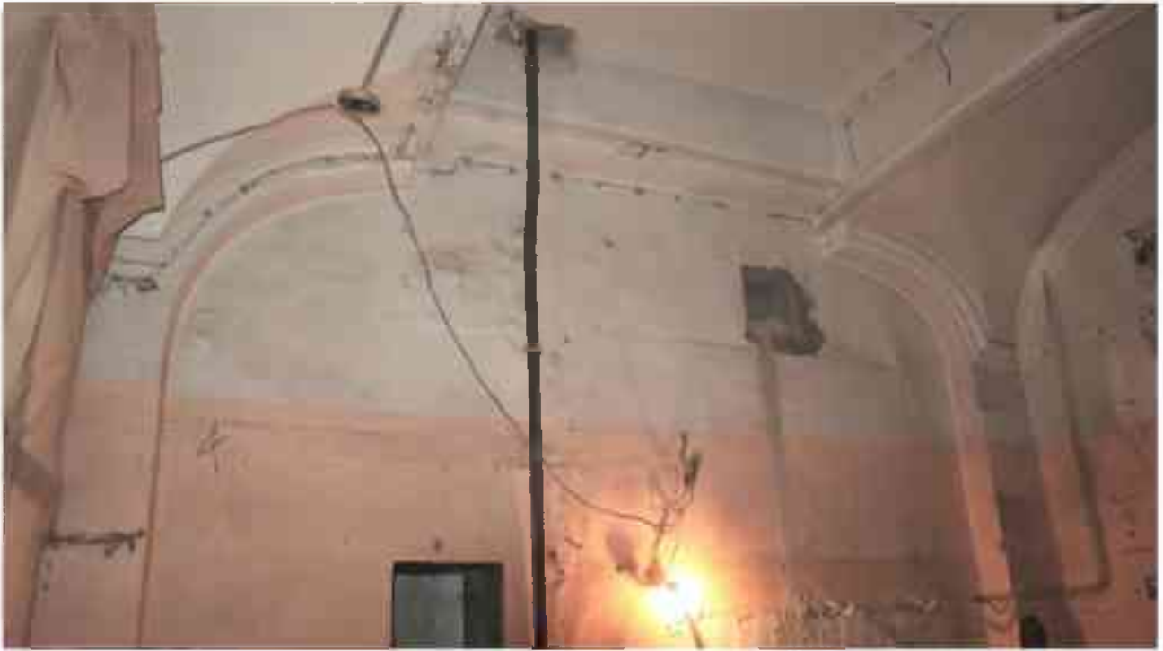
Фото 1.202. 1 этаж, помещение 12Н (1).
