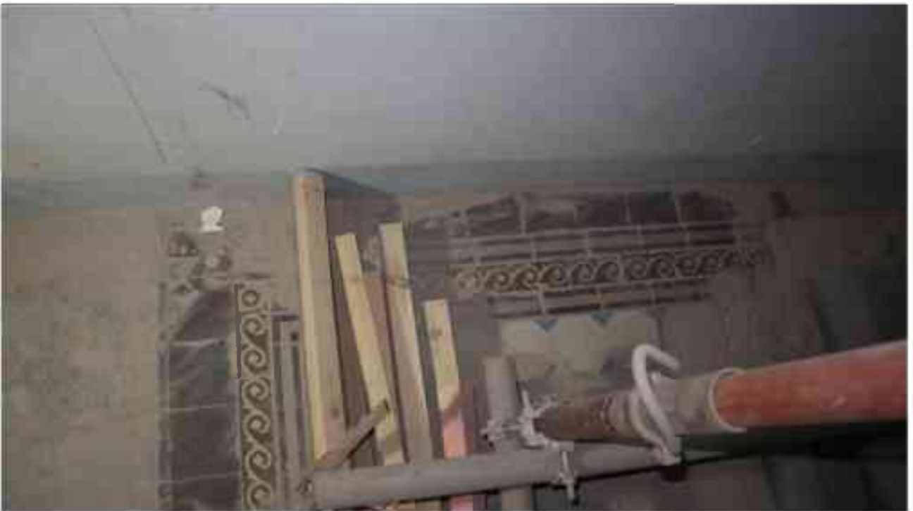
Фото 1.109. 1 этаж, лестница Л-16.
