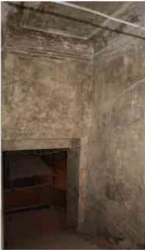
Фото 4.127. 4 этаж, лестница в ризалите южного фасада (западная часть).*
