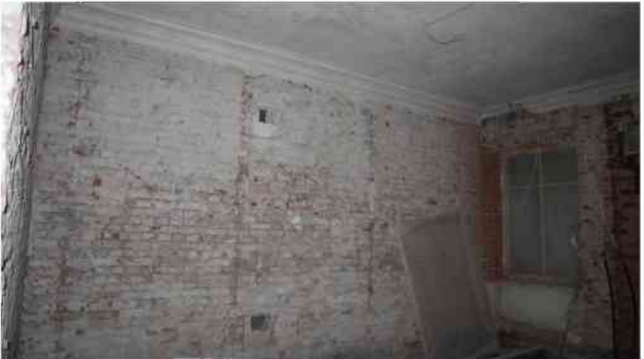
Фото 4.54. 4 этаж, помещение 33Н (29).
