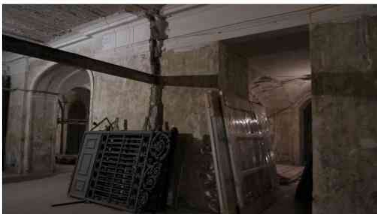
Фото 1.247. 1 этаж, помещение 13Н (5-6).
