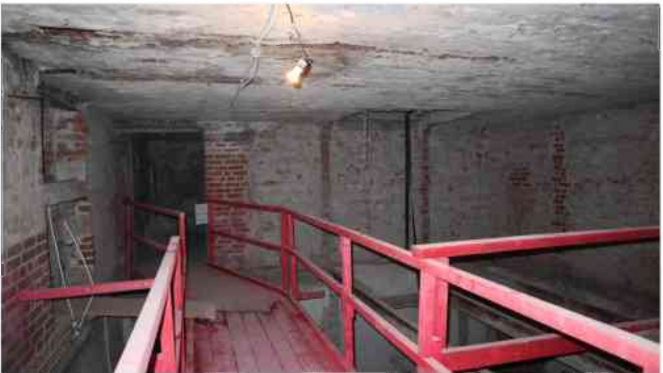
Фото 5.43. 5 этаж, помещение 38Н (2).
