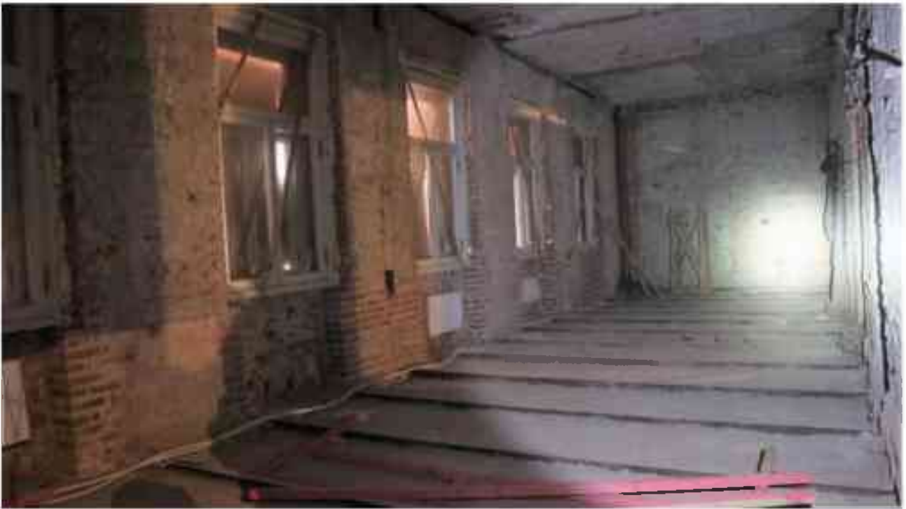
Фото 2.209. 2 этаж, помещение 22Н (2-6, 9).
