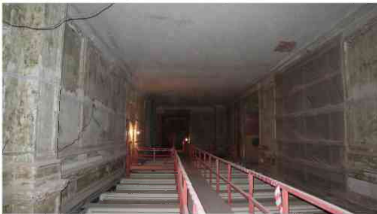
Фото 2.79. 2 этаж, помещение 22Н (28).
