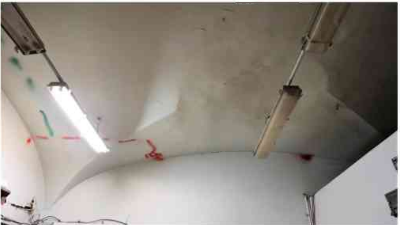
Фото 1.49. 1 этаж, помещение 14Н (7).
