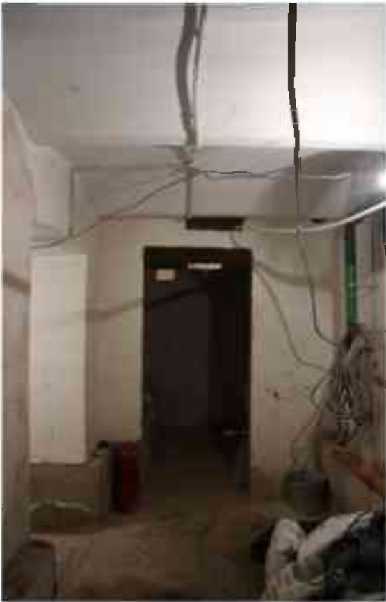
Фото п.91. Подвал, помещение 4Н (2).
