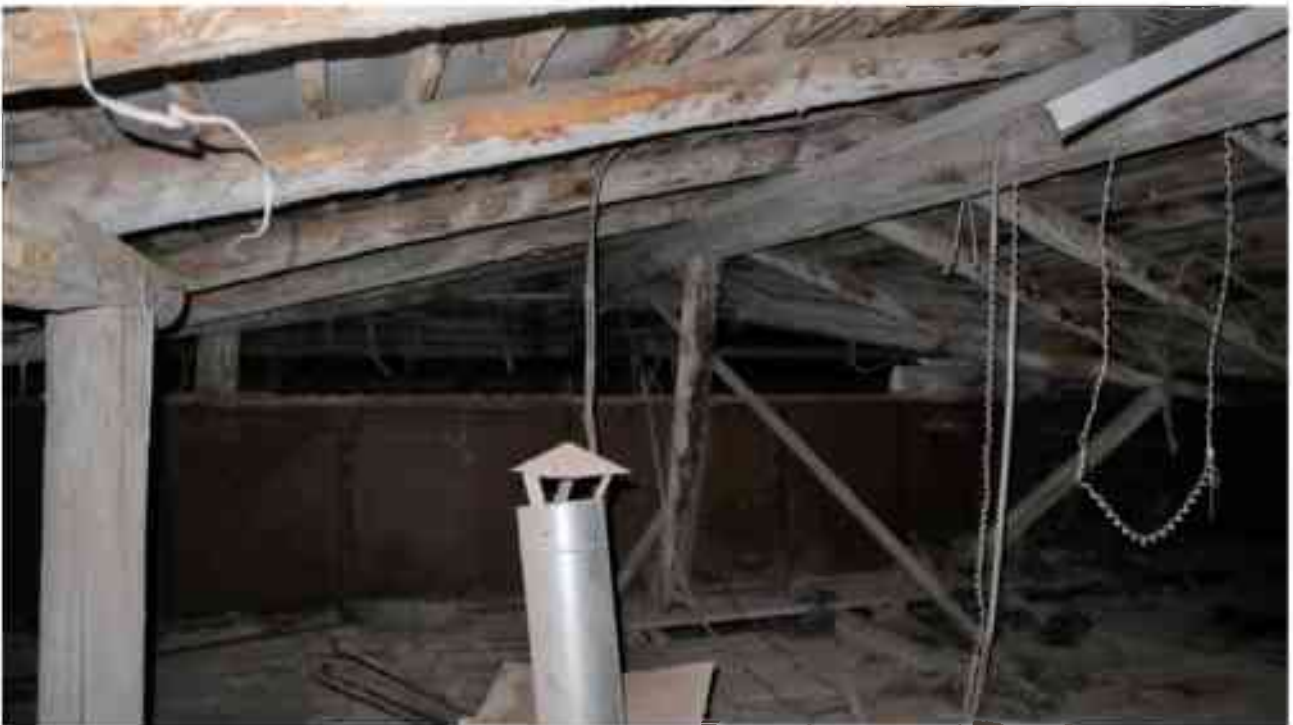
Фото 6.61. 6 этаж, чердачное помещение.
