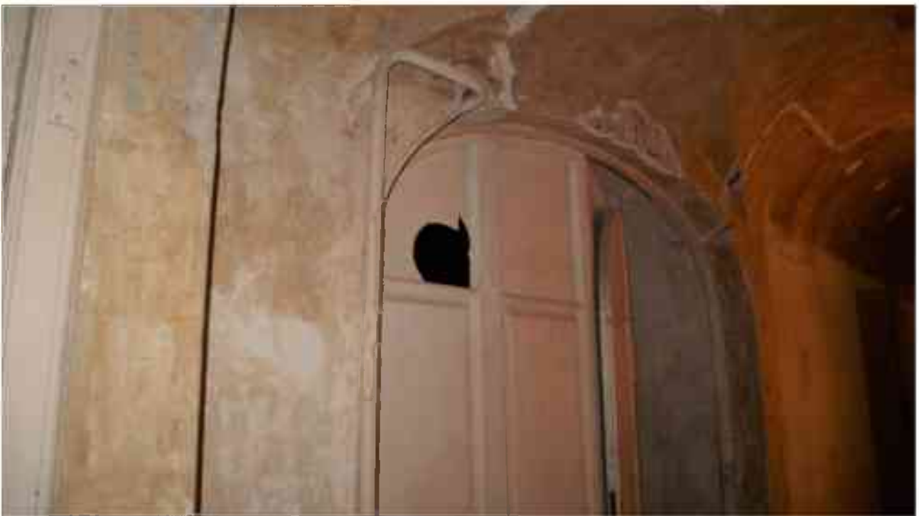
Фото 1.162. 1 этаж, помещение 31Н (15).
