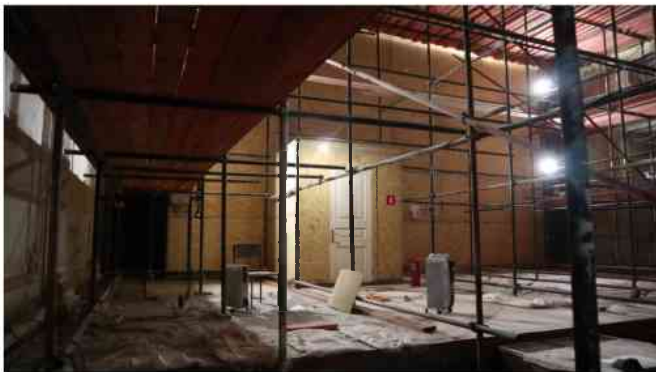
Фото 3.72. 3 этаж, помещение 28Н (2).
