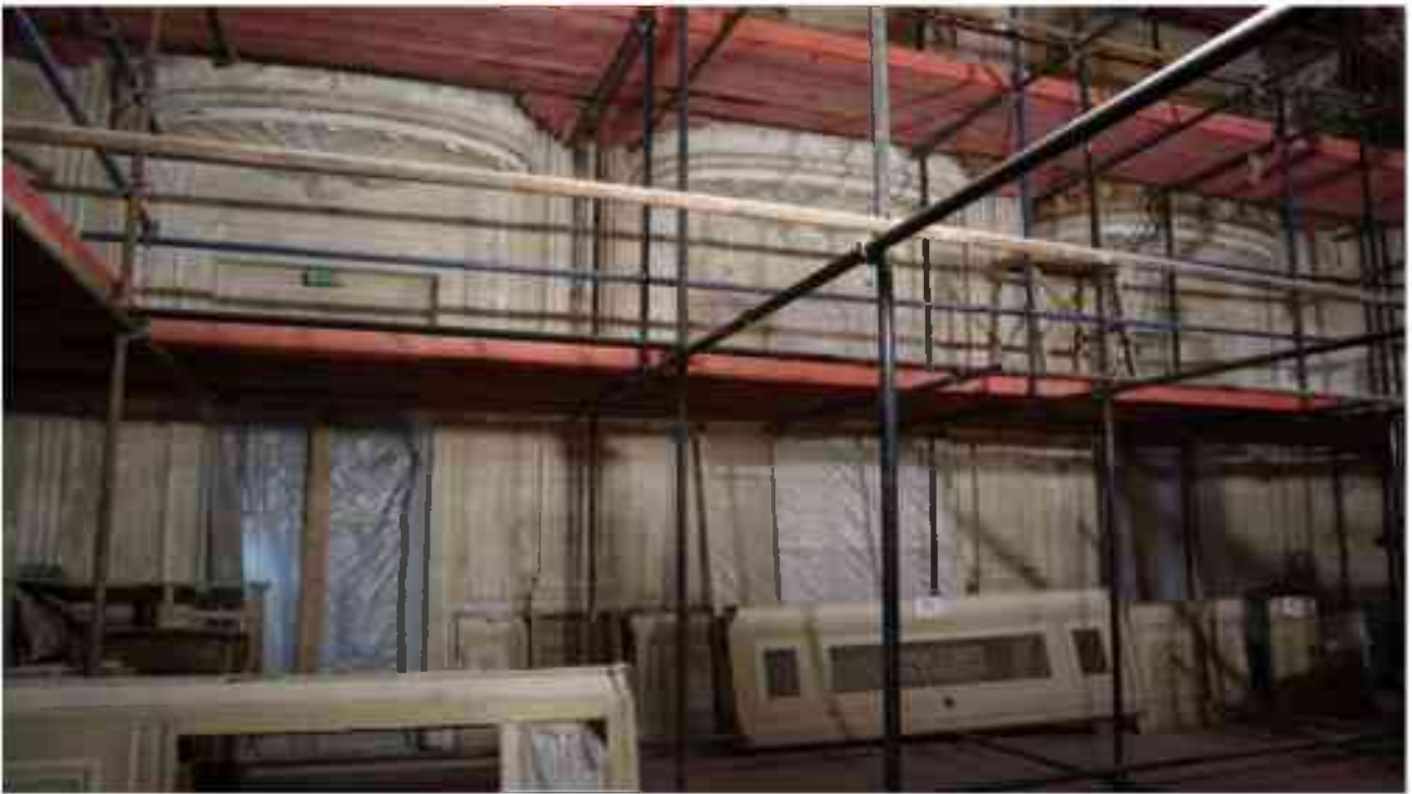
Фото 3.75. 3 этаж, помещение 28Н (2).
