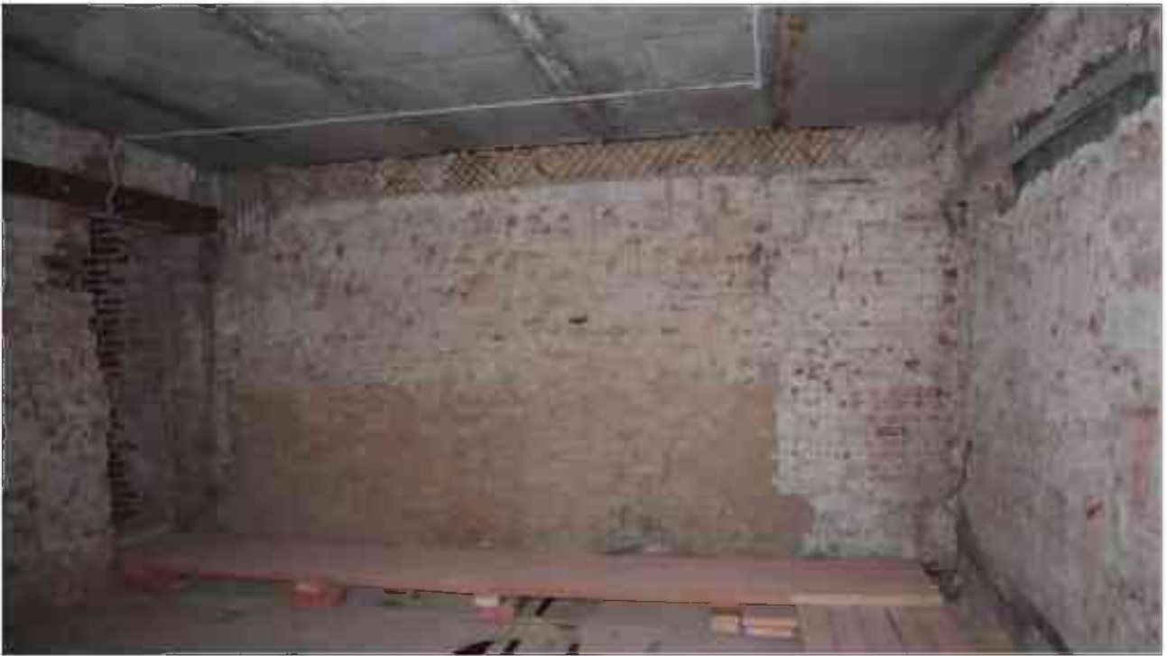
Фото 4.198. 4 этаж, помещение 42Н* (5-7).
