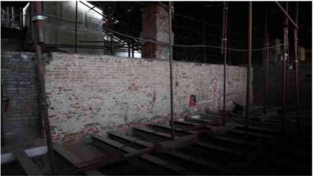
Фото 5.174. 5 этаж, чердачное помещение.
