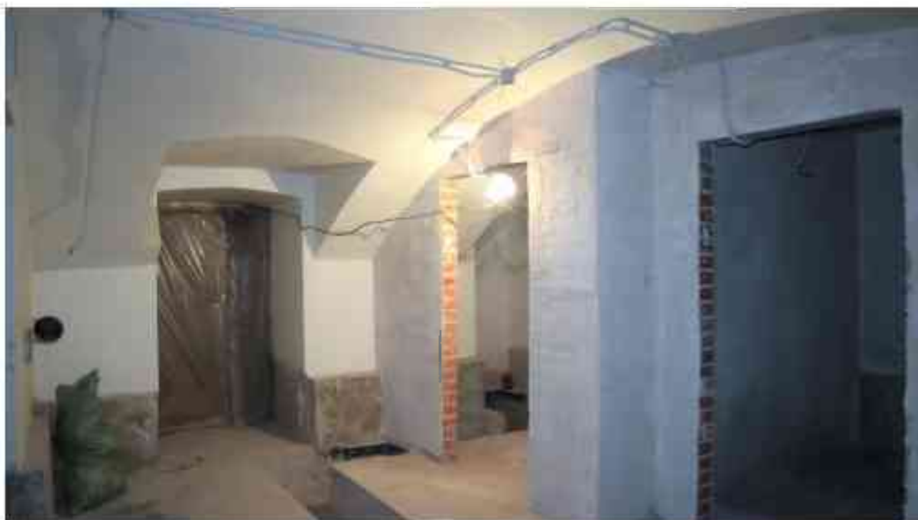
Фото п.212. Подвал, помещение 9Н (4).
