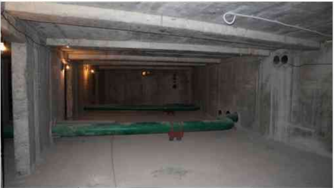
Фото п.34. Подвал, помещение 3Н (12).
