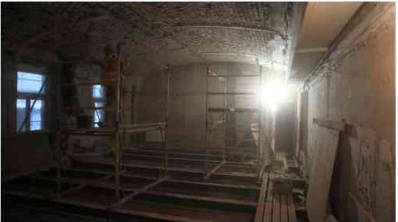
Фото 1.198. 1 этаж, помещение 11Н (1-3, 5).
