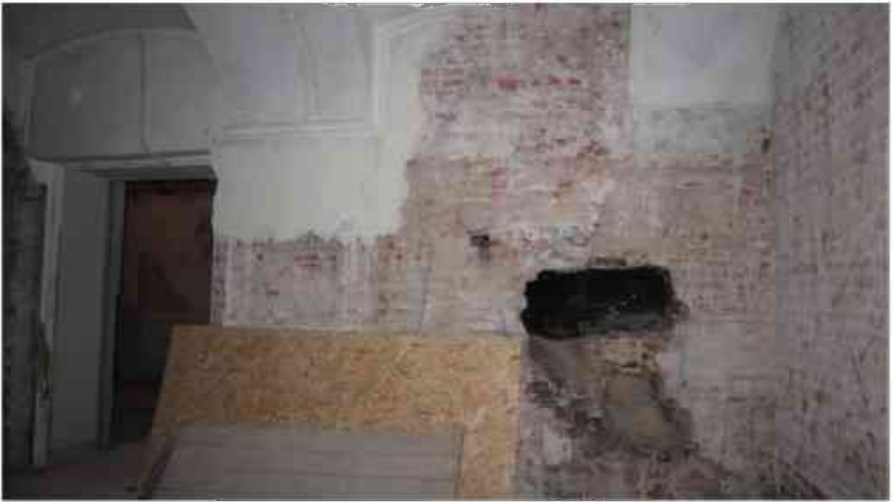
Фото 2.5. 2 этаж, помещение 22Н (42).
