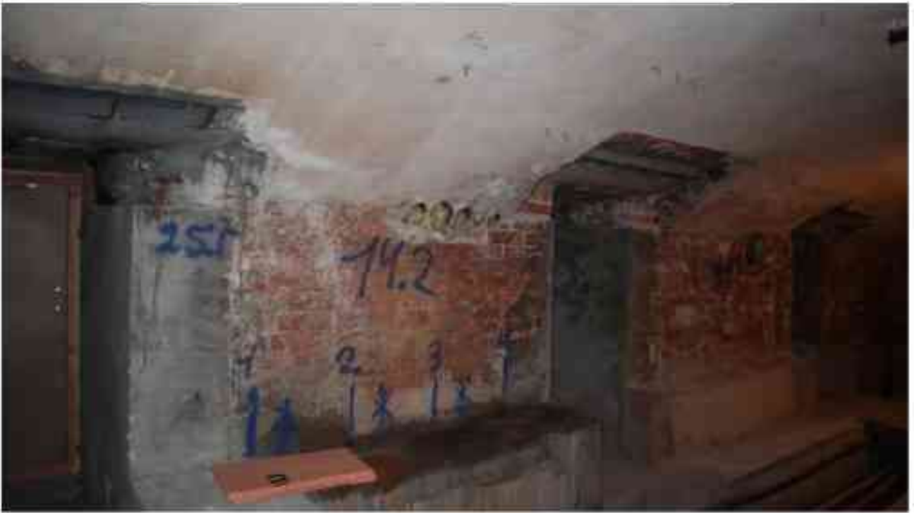
Фото п.193. Подвал, помещение 9Н (21).
