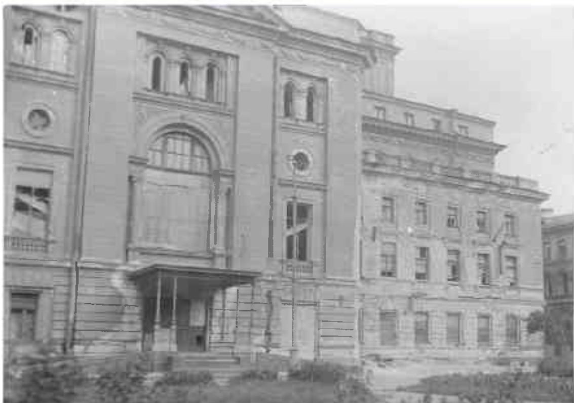
Ил. 187. Часть главного фасада здания Ленинградской государственной консерватории имени Н.А. Римского-Корсакова (Театральная пл., 3), поврежденного артиллерийским обстрелом.
