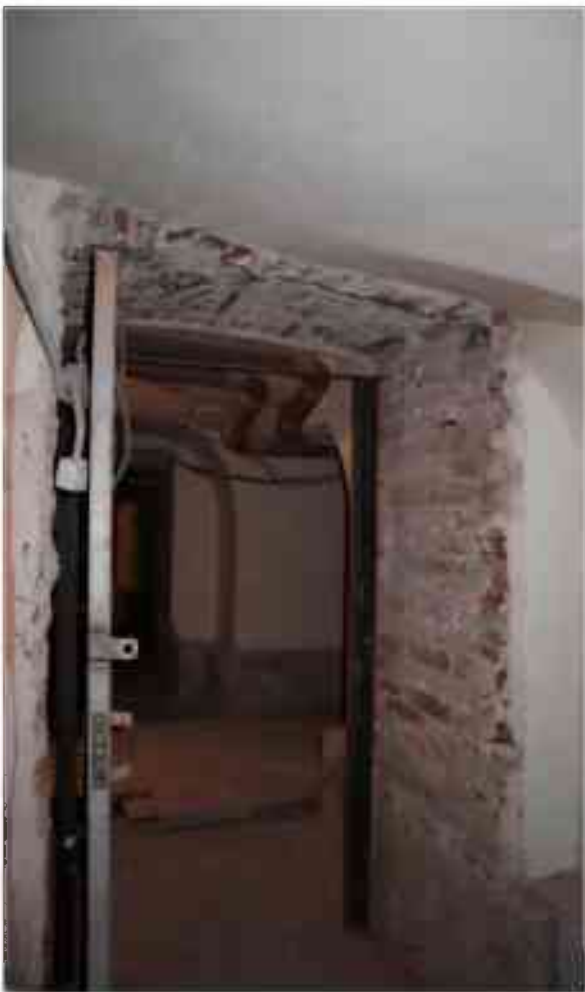
Фото п.175. Подвал, помещение 9Н (9).
