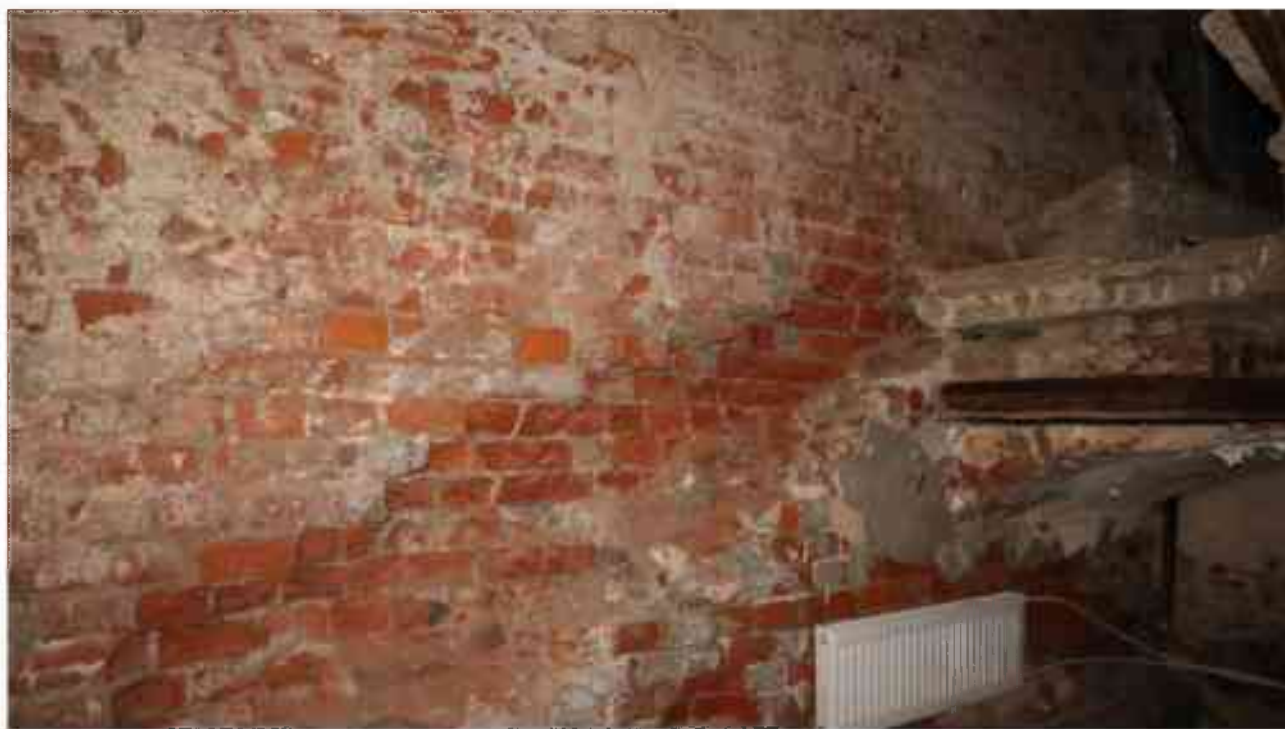
Фото п.223. Подвал, помещение 9Н (2), лестница Л-17.
