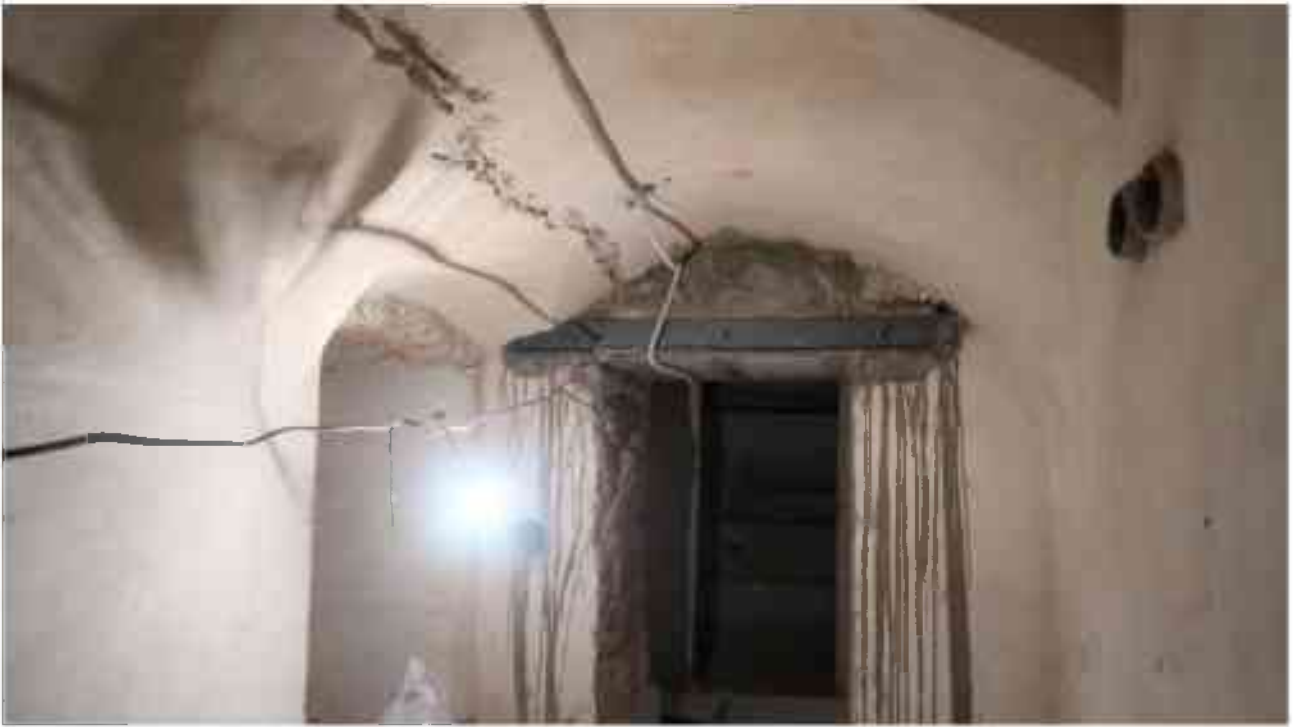
Фото п.204. Подвал, помещение 9Н (25).
