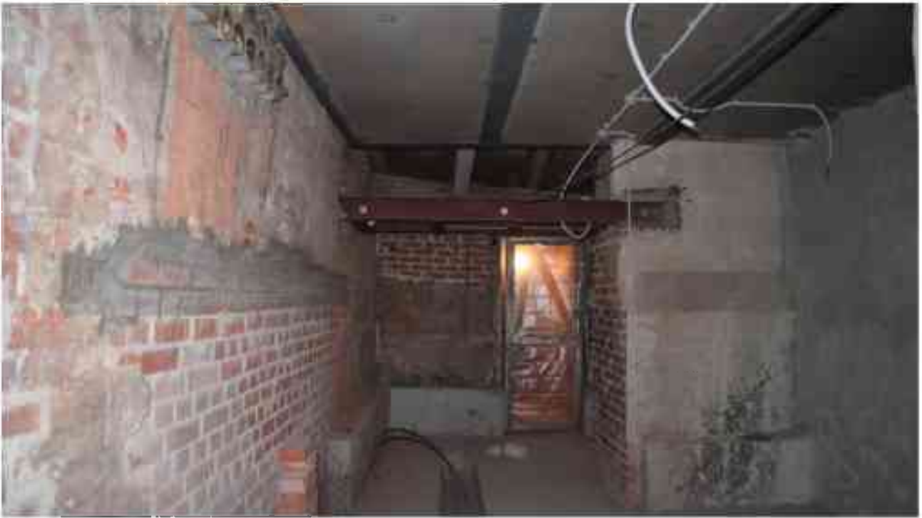
Фото п.229. Подвал, помещение 9Н (3, 23, 24).
