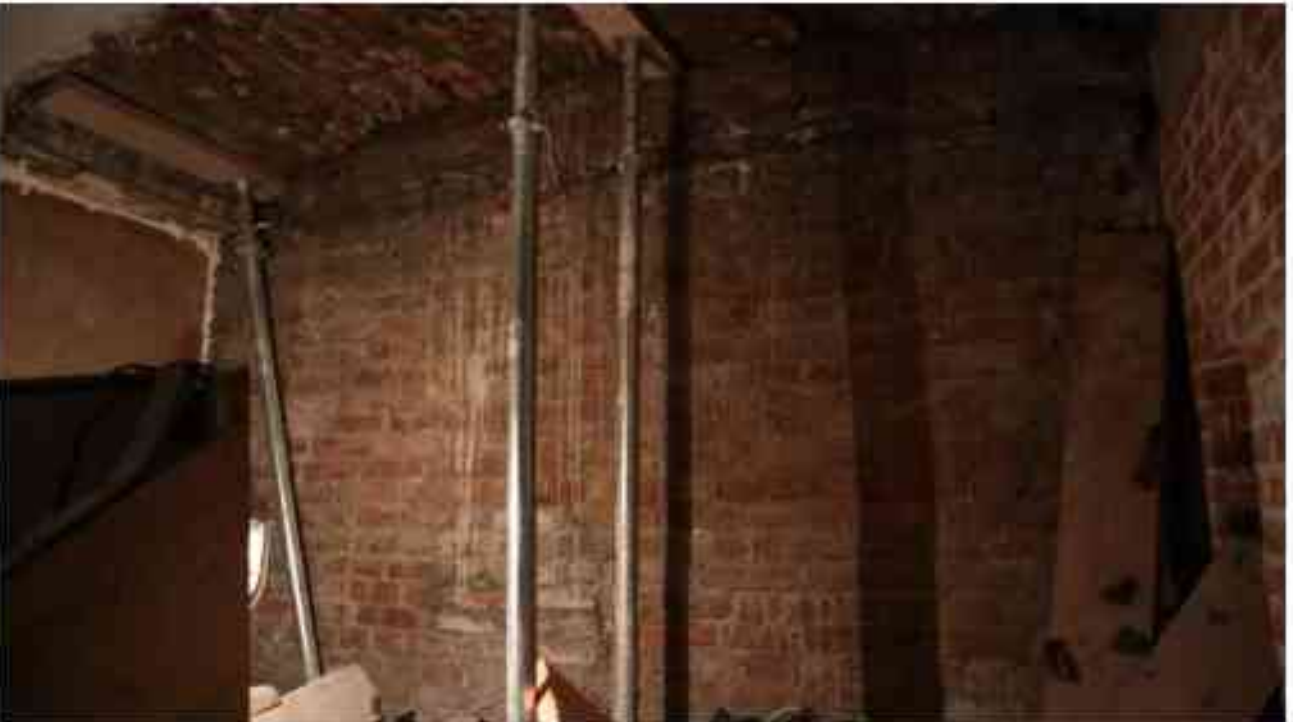
Фото 5.199. 5 этаж, лестница Л-20.
