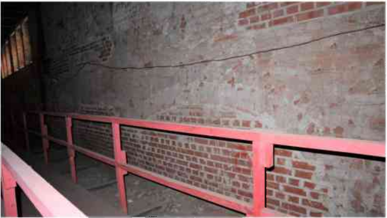
Фото 5.63. 5 этаж, помещение 35Н (4-6).
