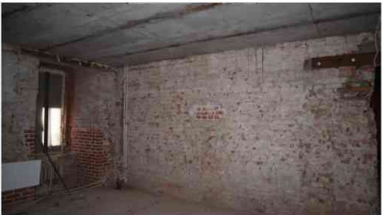
Фото 4.197. 4 этаж, помещение 42Н* (5-7).
