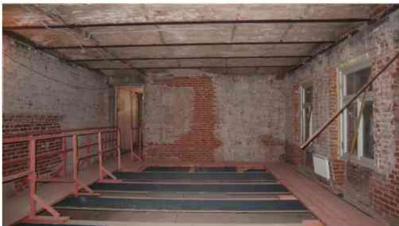
Фото 4.101. 4 этаж, помещение 36Н (1-3, 7-9).
