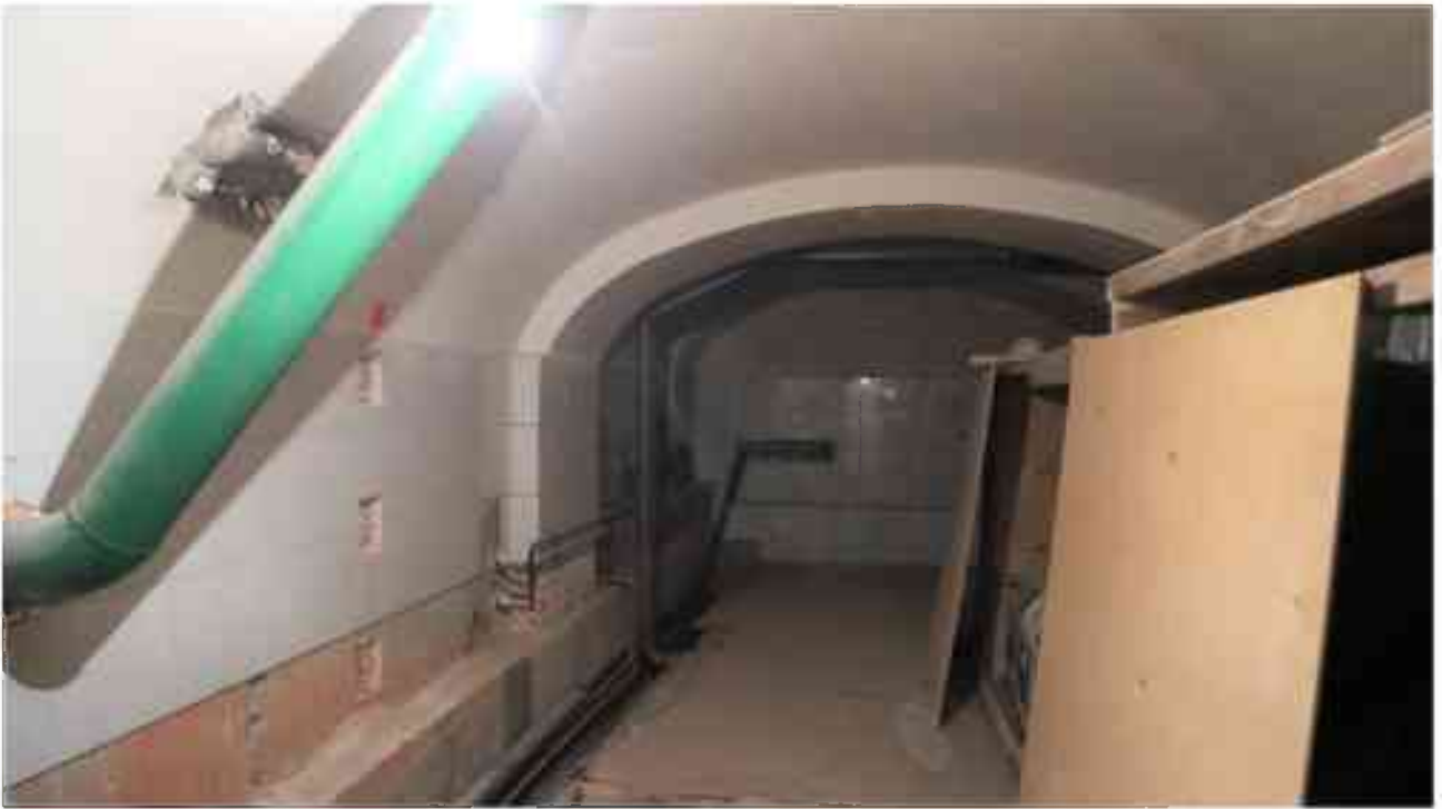
Фото п.177. Подвал, помещение 9Н (8).
