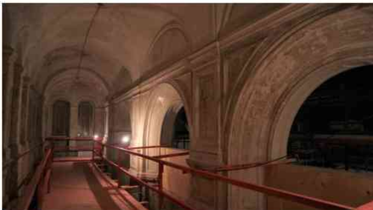
Фото 4.153. 4 этаж, помещение 30Н (4).
