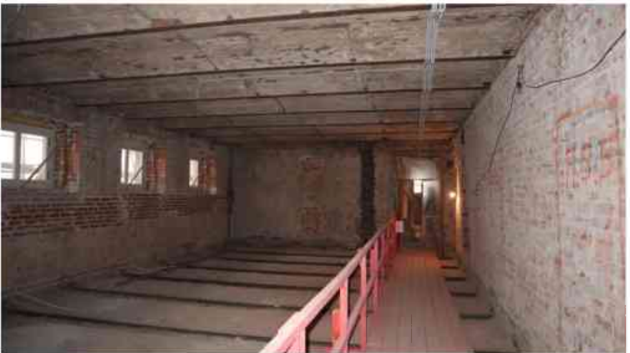
Фото 5.31. 5 этаж, помещение 35Н (21, 23-27).
