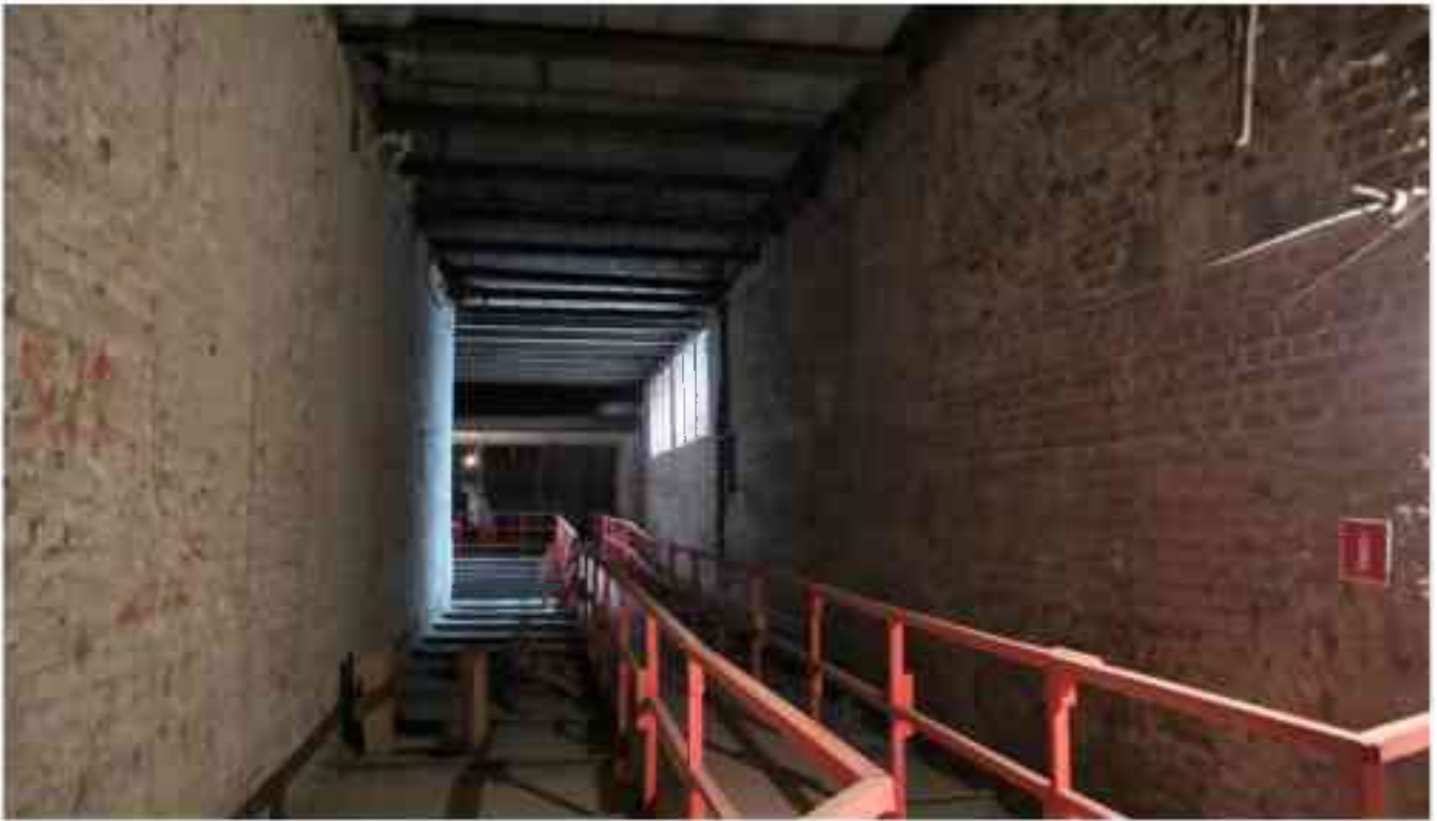
Фото 5.61. 5 этаж, помещение 35Н (5-6).
