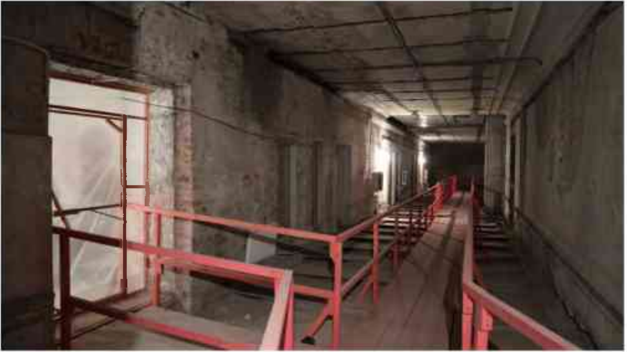
Фото 4.132. 4 этаж, помещение 30Н (1).
