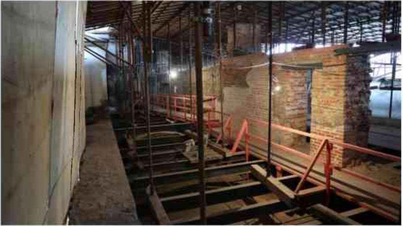
Фото 5.184. 5 этаж, коридор, помещения 34Н/37Н.
