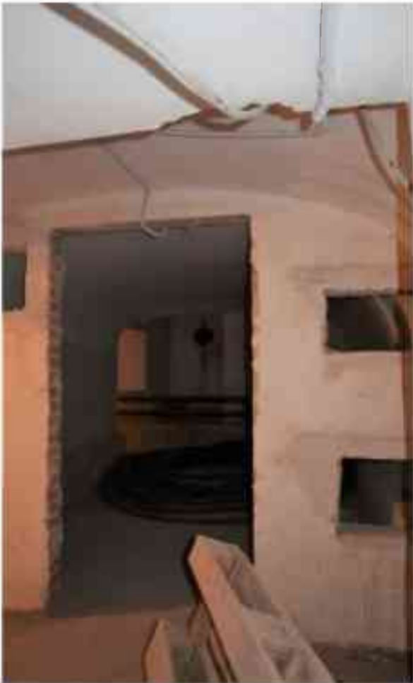
Фото п.94. Подвал, помещение 4Н (1).
