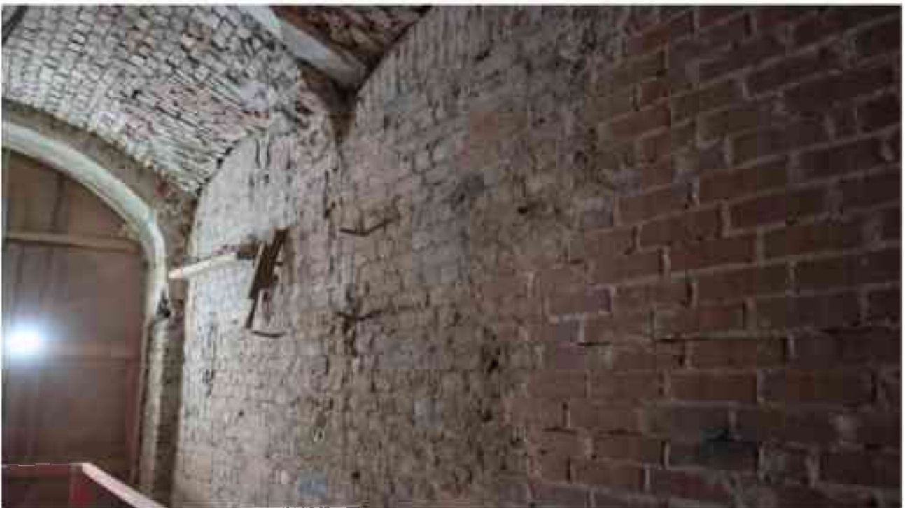
Фото 1.208. 1 этаж, помещение 12Н (2).
