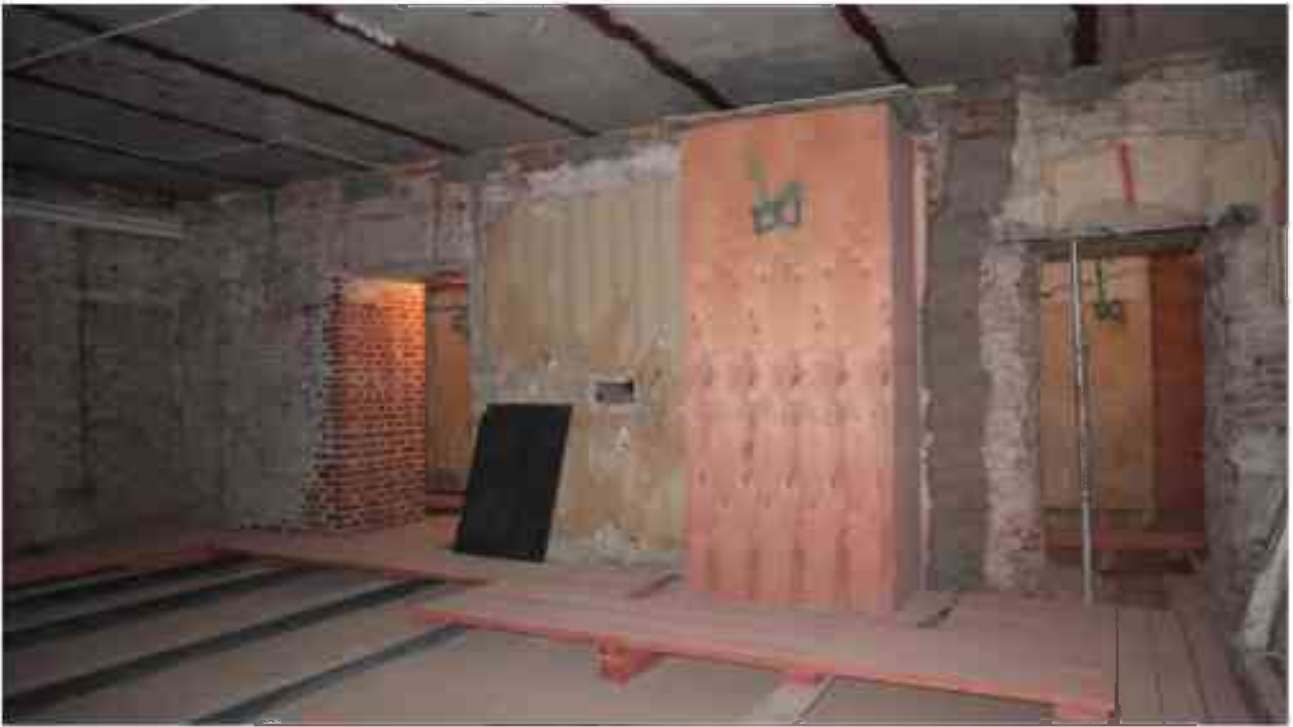
Фото 4.87. 4 этаж, помещение 33Н (5-6).
