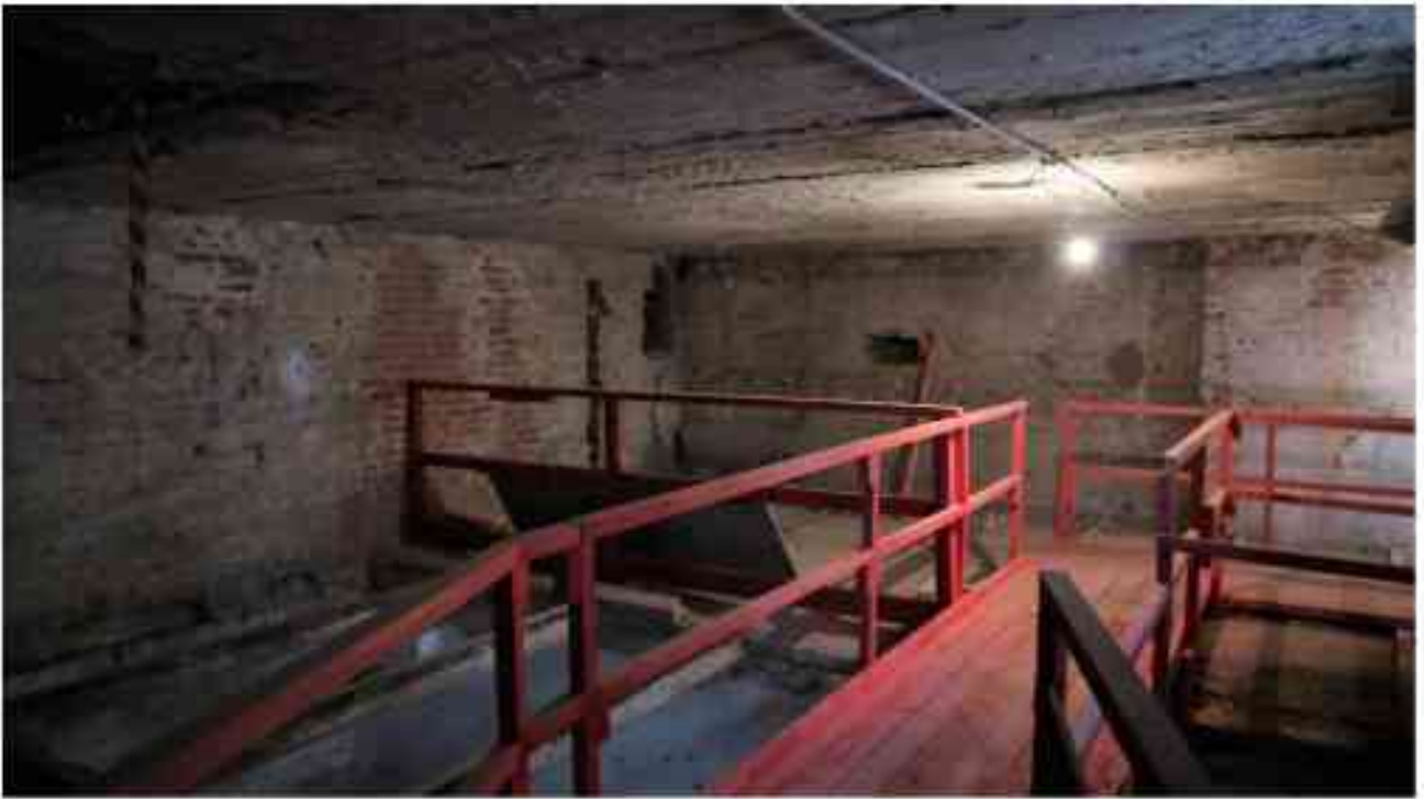
Фото 5.44. 5 этаж, помещение 38Н (2).
