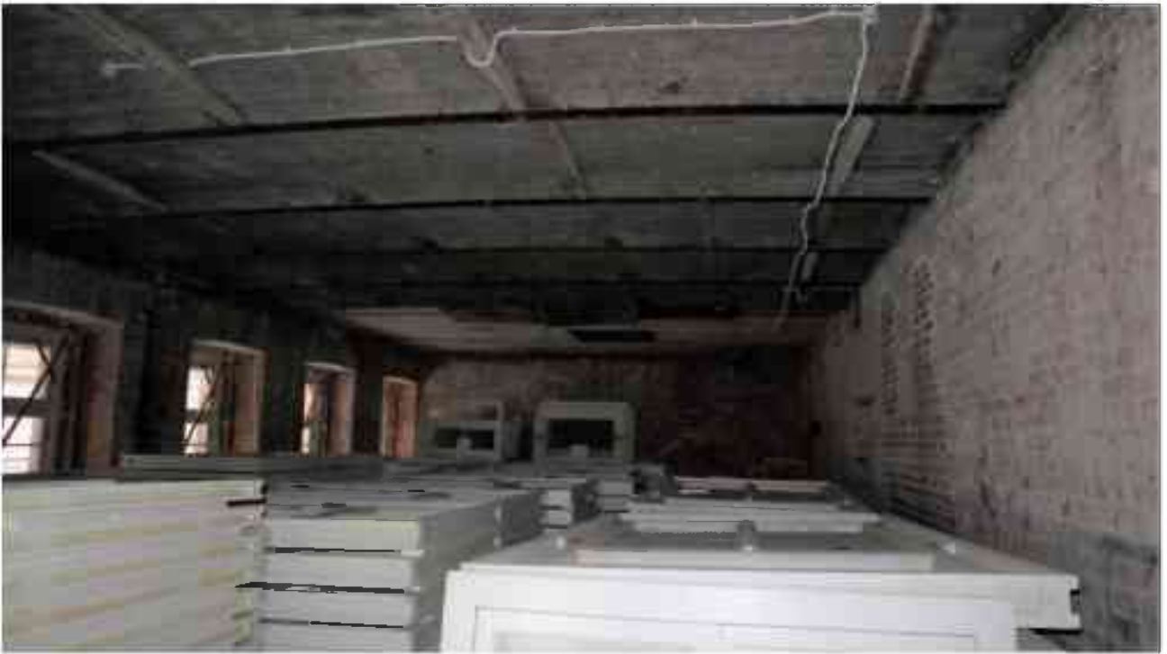
Фото 1.88. 1 этаж, помещение 14Н (36-42).
