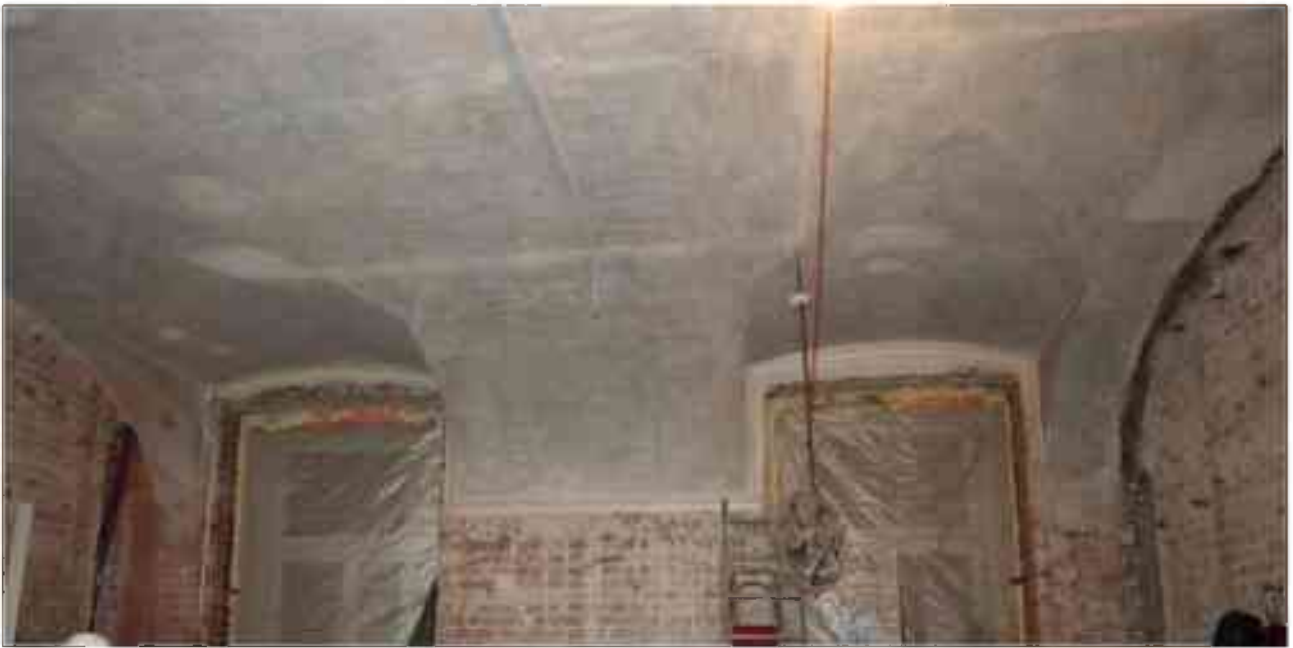
Фото 2.33. 2 этаж, помещение 22Н (49).
