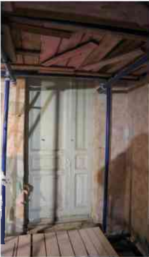
Фото 3.46. 3 этаж, помещение 28Н (20-21).
