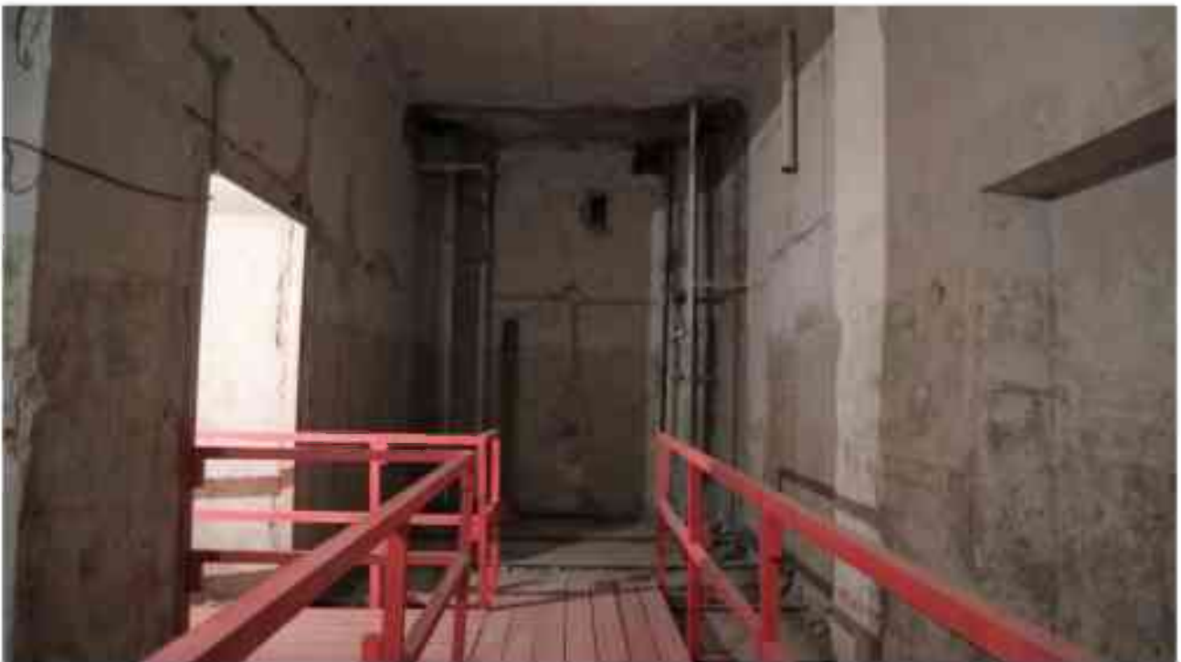
Фото 3.160. 3 этаж, помещение 23Н (8).
