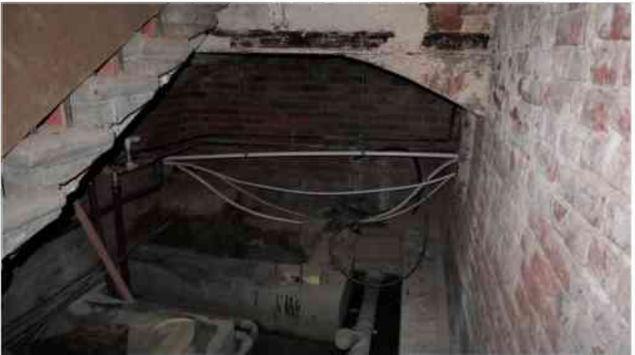
Фото п.2. Подвал, лестница Л-6.
