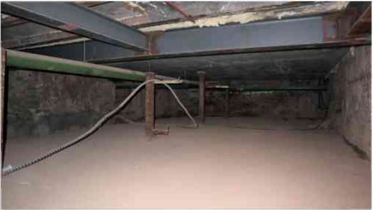
Фото п.299. Подвал, помещение 6Н (8).
