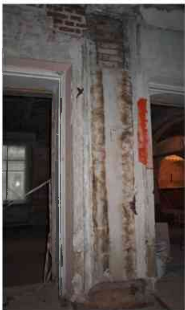
Фото 4.39. 4 этаж, помещение 33Н (40, 41).
