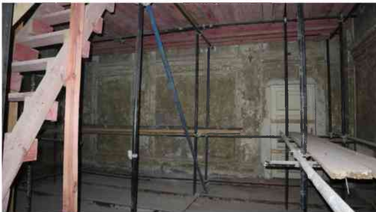
Фото 3.145. 3 этаж, помещение 25Н (11).
