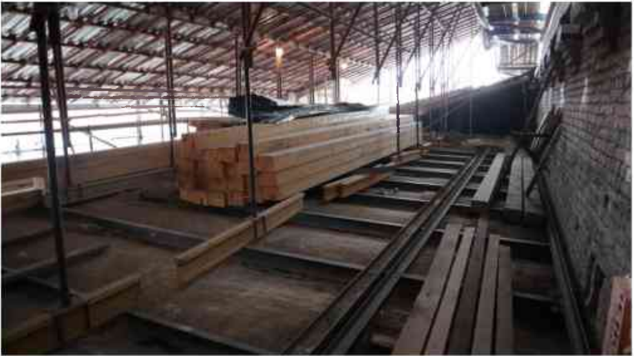
Фото 6.48. 6 этаж, чердачное помещение.
