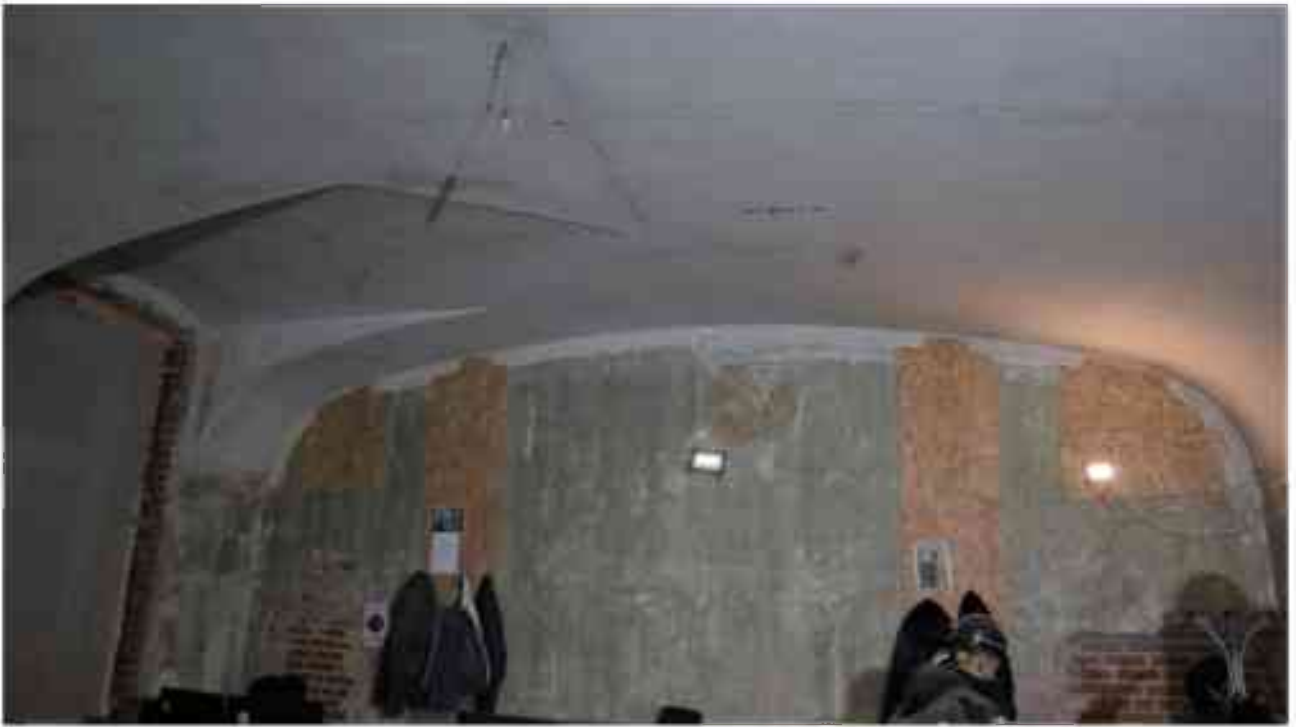
Фото 3.23. 3 этаж, помещение 28Н (24).
