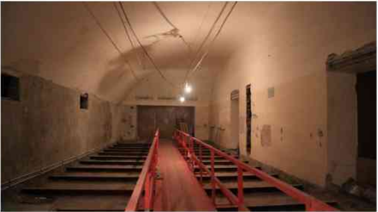
Фото 5.96. 5 этаж, помещение 35Н(1).
