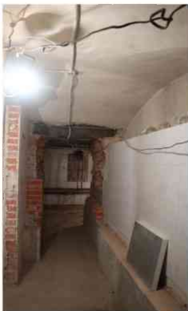
Фото п.268. Подвал, помещение 6Н (12, 8).
