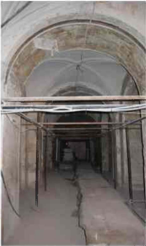
Фото 1.250. 1 этаж, помещение 13Н (15).
