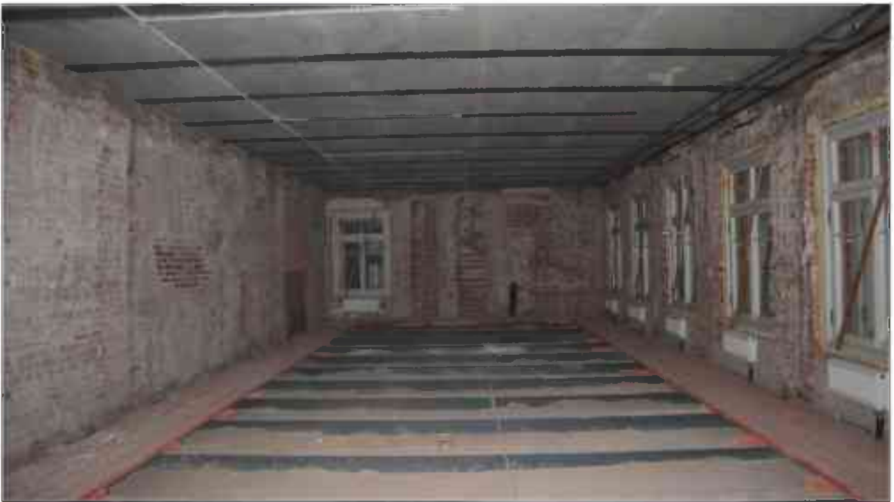
Фото 4.74. 4 этаж, помещение 33Н (16-20).
