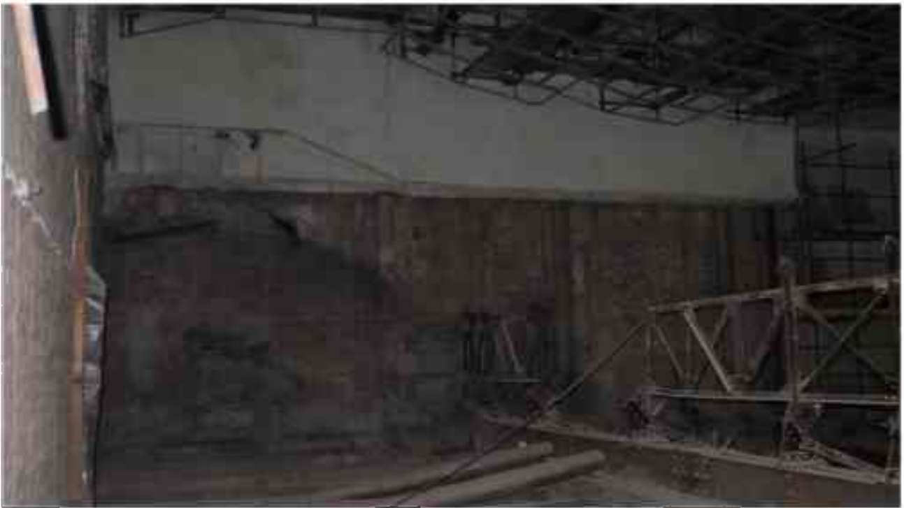
Фото 4.200. 4 этаж, помещение 30Н (3).
