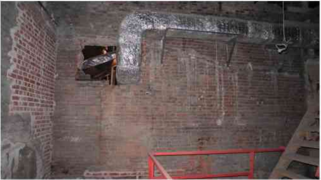
Фото 5.73. 5 этаж, помещение 35Н (4-6).
