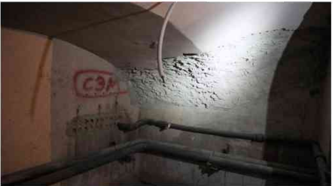
Фото п.251. Подвал, помещение 6Н (2).
