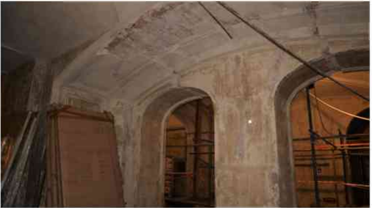
Фото 1.284. 1 этаж, помещение 13Н (4).
