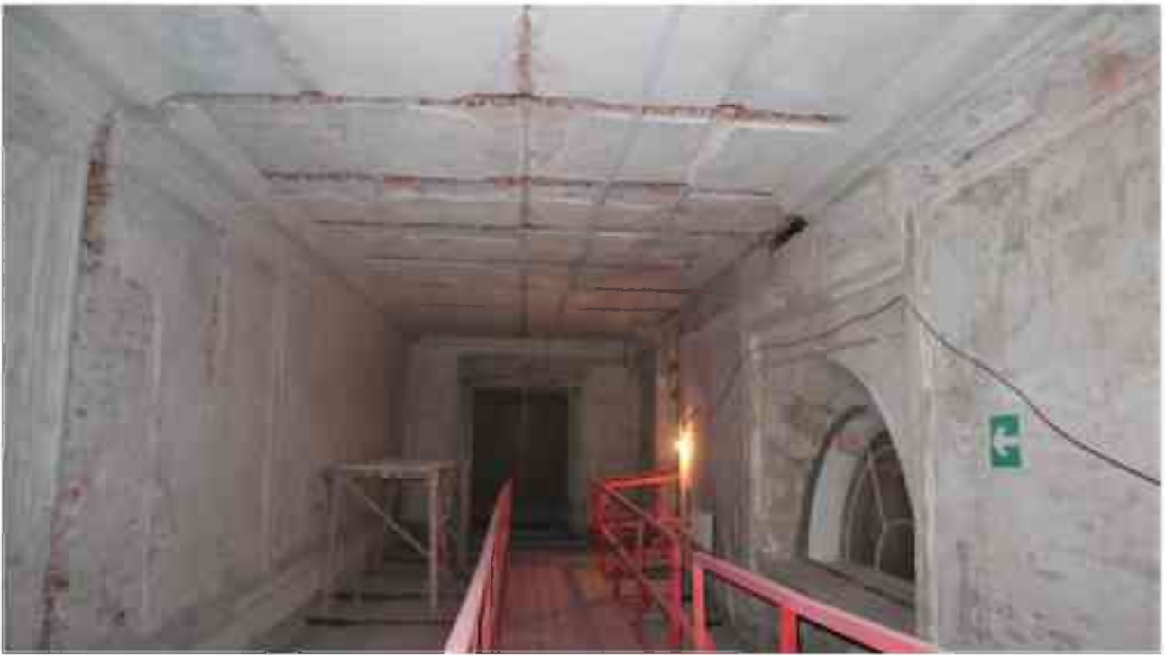
Фото 3.136. 3 этаж, помещение 25Н (1).
