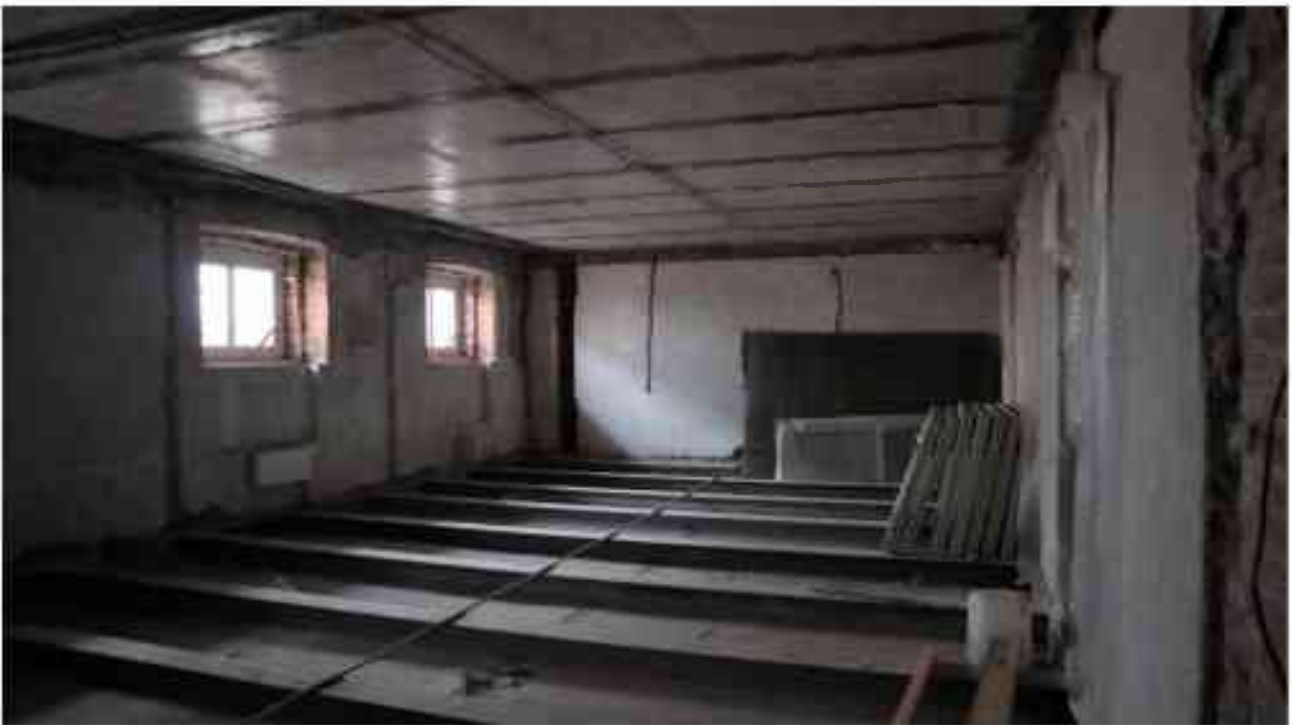
Фото 5.13. 5 этаж, помещение 37Н (2-5).
