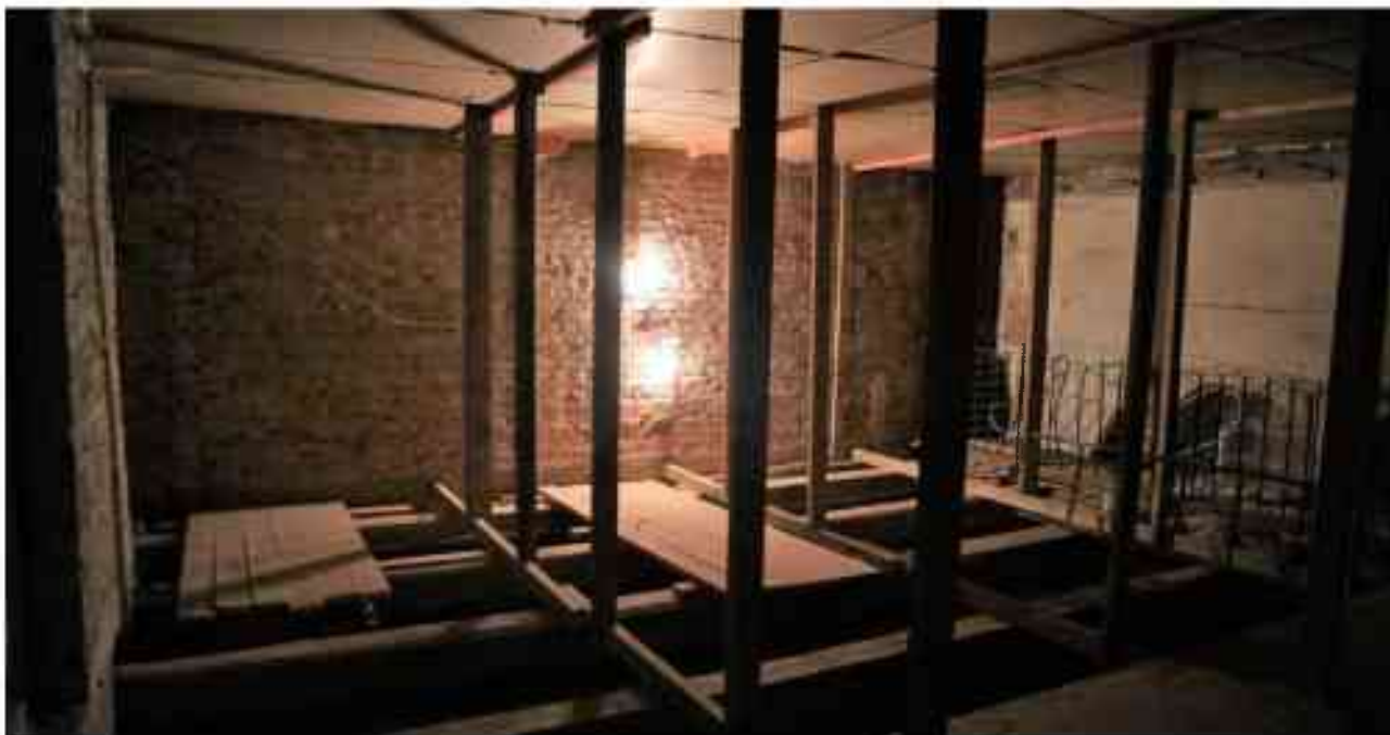
Фото 4.183. 4 этаж, помещение 32Н (1-2).
