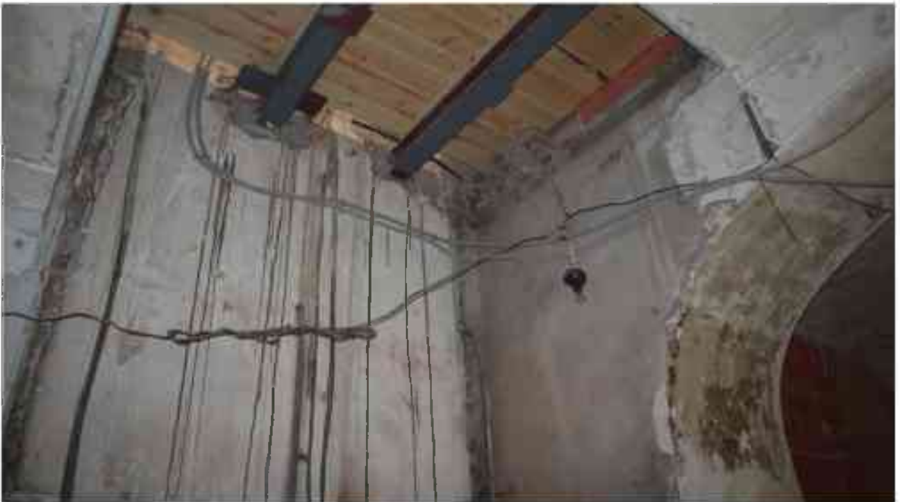
Фото 1.105. 1 этаж, помещение 14Н (29).
