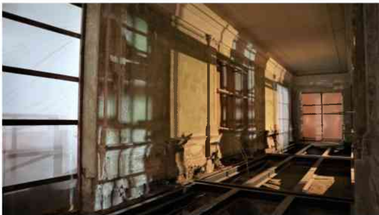
Фото 2.157. 2 этаж, помещение 22Н (20).
