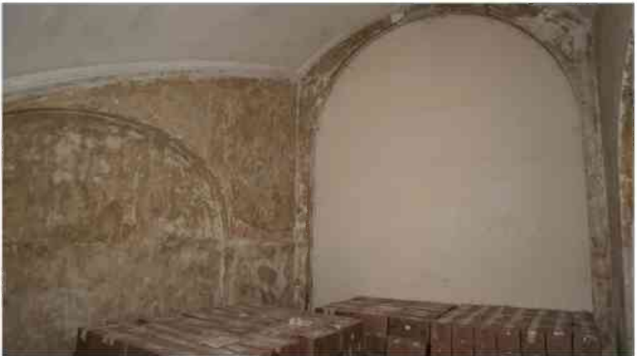
Фото 1.259. 1 этаж, помещение 13Н (34).
