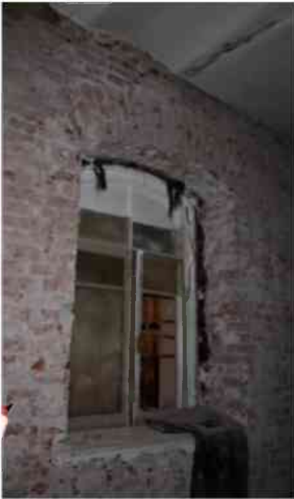
Фото 4.30. 4 этаж, помещение 33Н (33).
