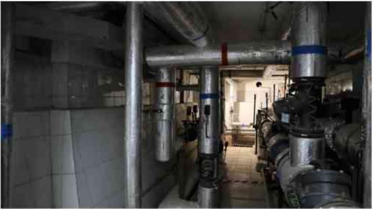
Фото п.322. Подвал, помещение 18Н (1-2, 8).
