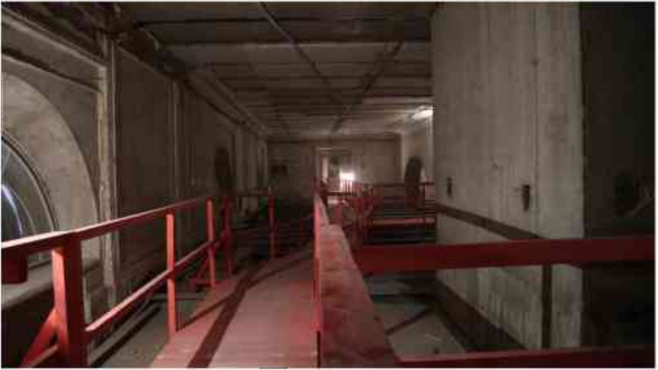
Фото 3.138. 3 этаж, помещение 25Н (1).
