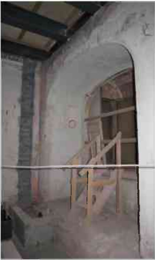
Фото 1.176. 1 этаж, помещение 31Н (19).
