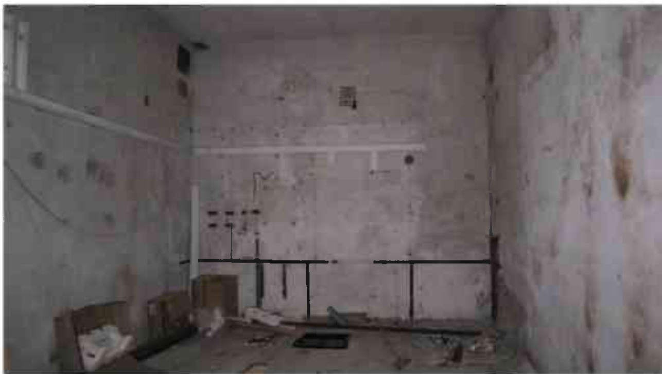
Фото 1.328. 1 этаж, помещение 16Н (1).
