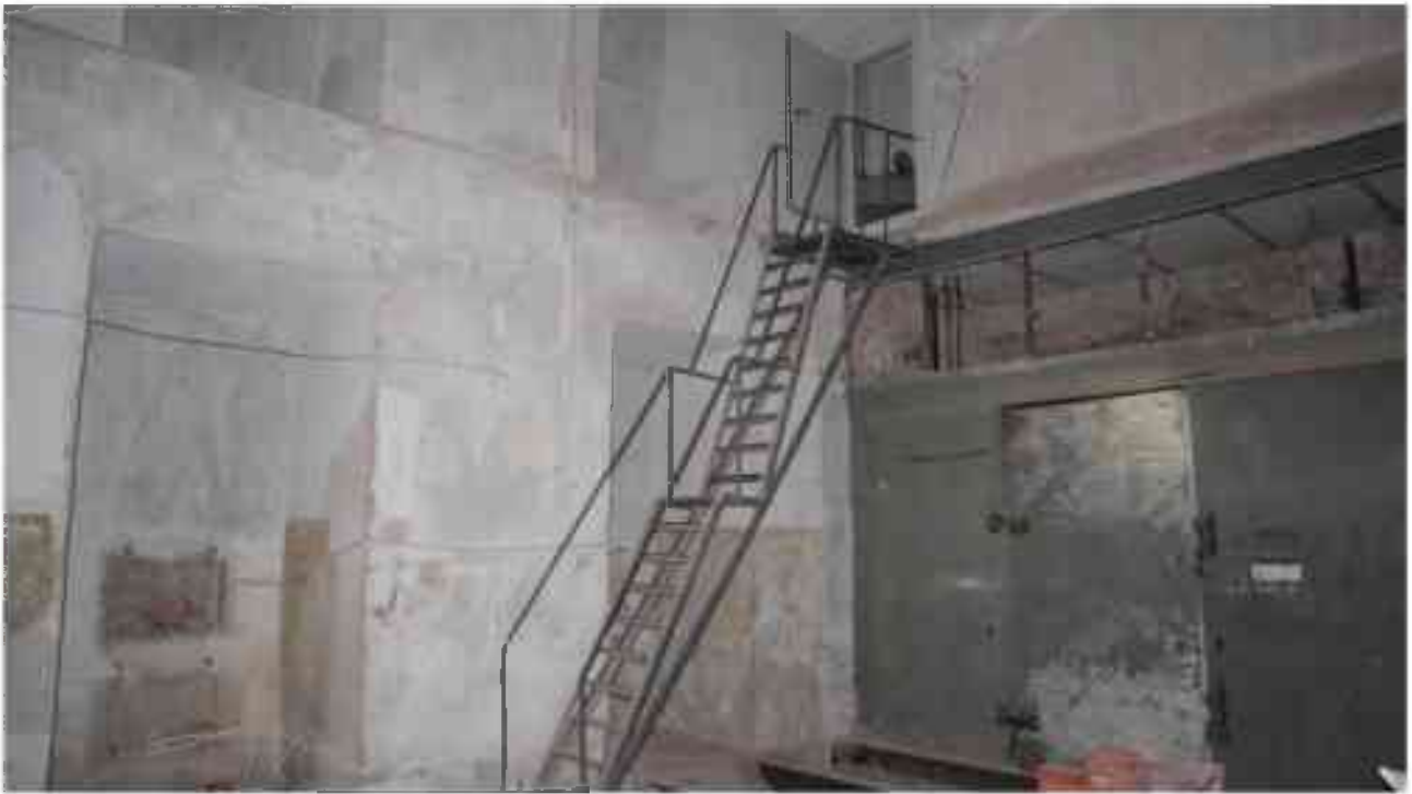
Фото 2.91. 2 этаж, помещение 22Н (80).
