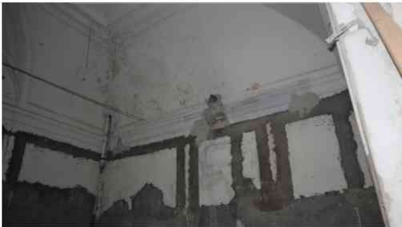
Фото 4.175. 4 этаж, помещение 30Н (8, 10-11).
