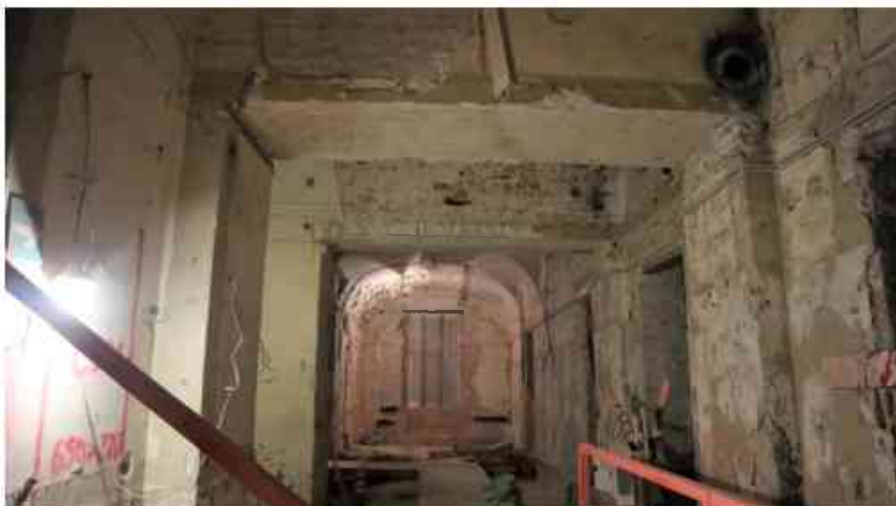
Фото 2.200. 2 этаж, помещение 22Н (10).
