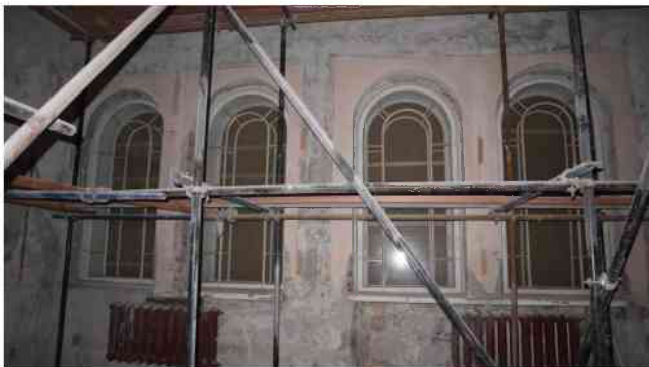
Фото 4.145. 4 этаж, помещение 30Н (12).
