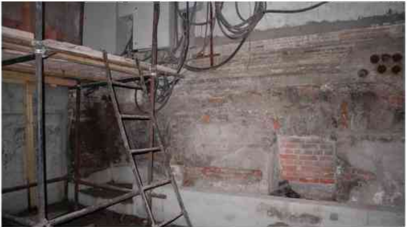
Фото п.313. Подвал, помещение 9Н (1).
