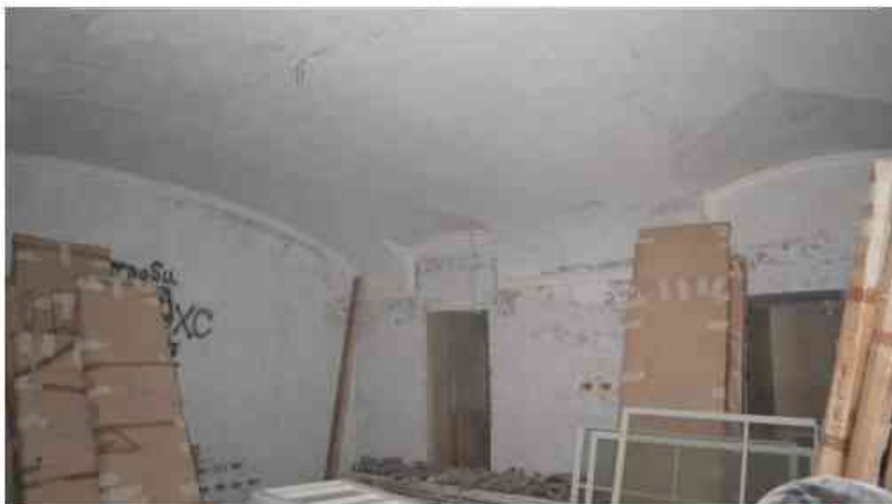
Фото 1.71. 1 этаж, помещение 14Н (21).
