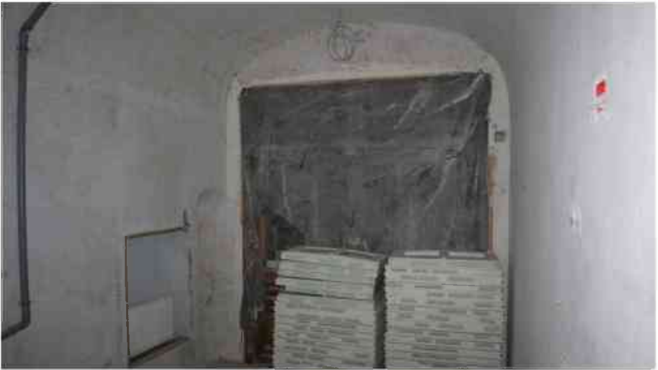
Фото 1.97. 1 этаж, лестница Л-4.
