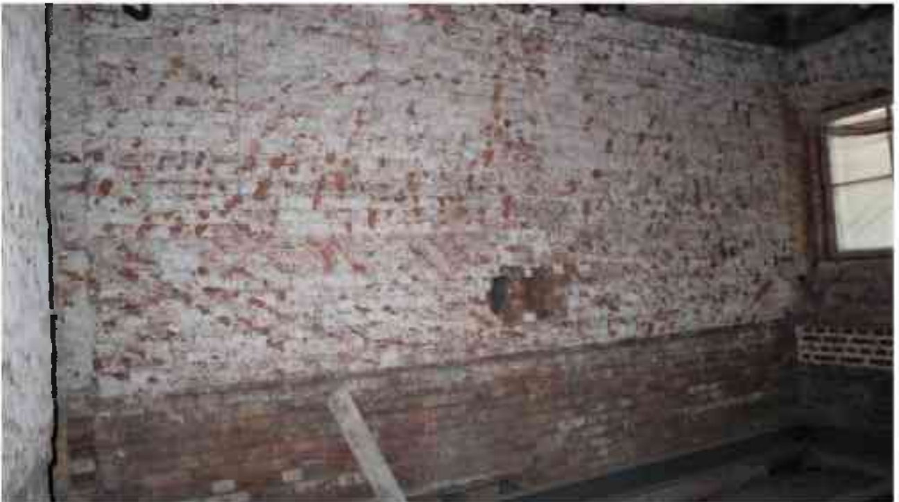
Фото 5.147. 5 этаж, жилой блок, на плане ПИБ 2000г. обозначен как квартиры, помещение (4-6).
