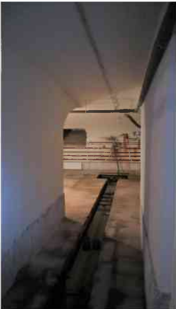
Фото п.253. Подвал, помещение 6Н (3).
