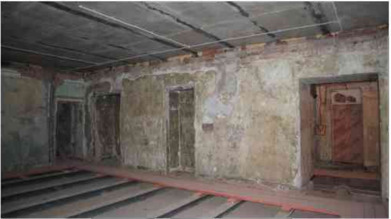
Фото 4.89. 4 этаж, помещение 33Н (8-10).
