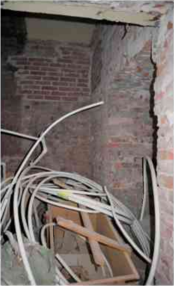
Фото 1.32. 1 этаж, помещение 14Н (15).
