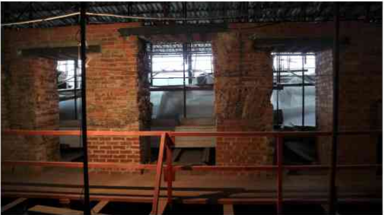
Фото 5.185. 5 этаж, коридор, помещения 34Н/37Н.
