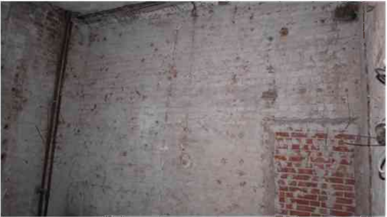
Фото 1.225. 1 этаж, помещение 15Н (7-11).
