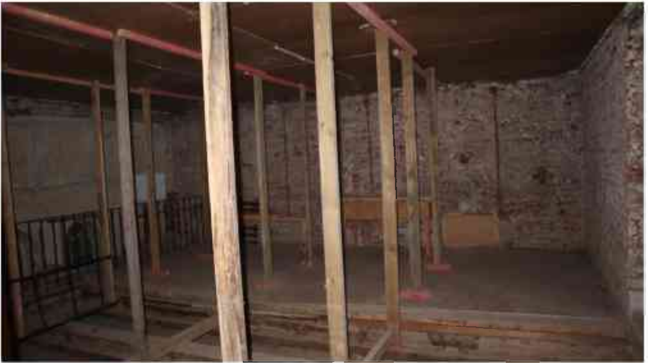
Фото 4.181. 4 этаж, помещение 32Н (1-2).
