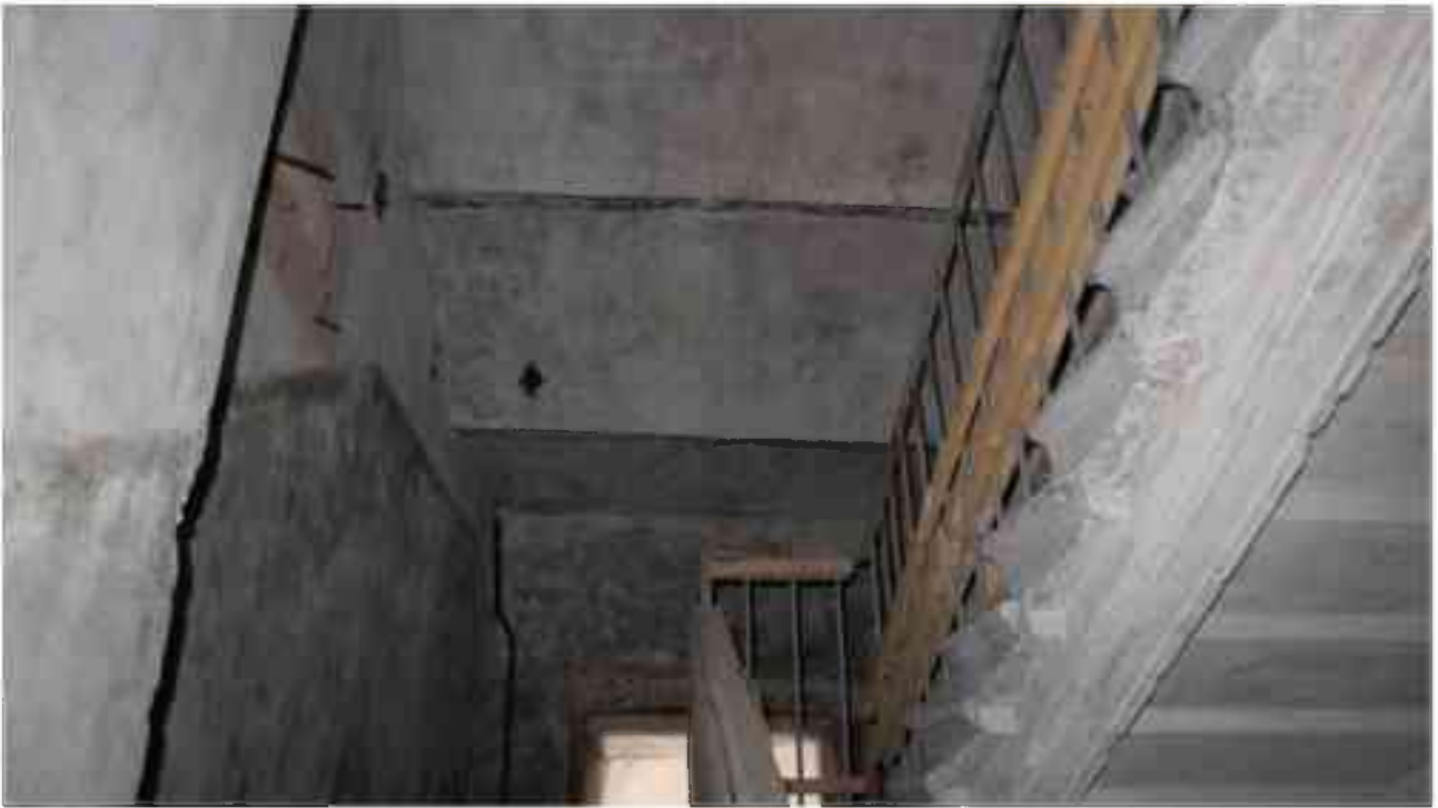
Фото 5.150. 5 этаж, лестница Л-17.
