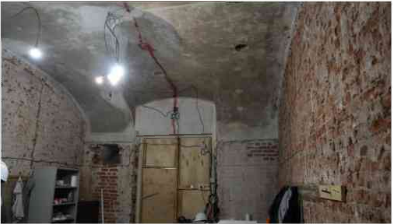
Фото 2.47. 2 этаж, помещение 22Н (63).
