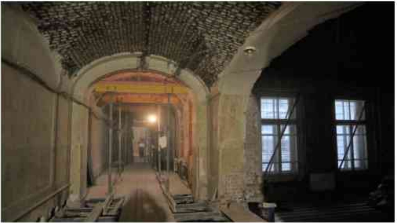
Фото 3.33. 3 этаж, помещение 28Н (27).
