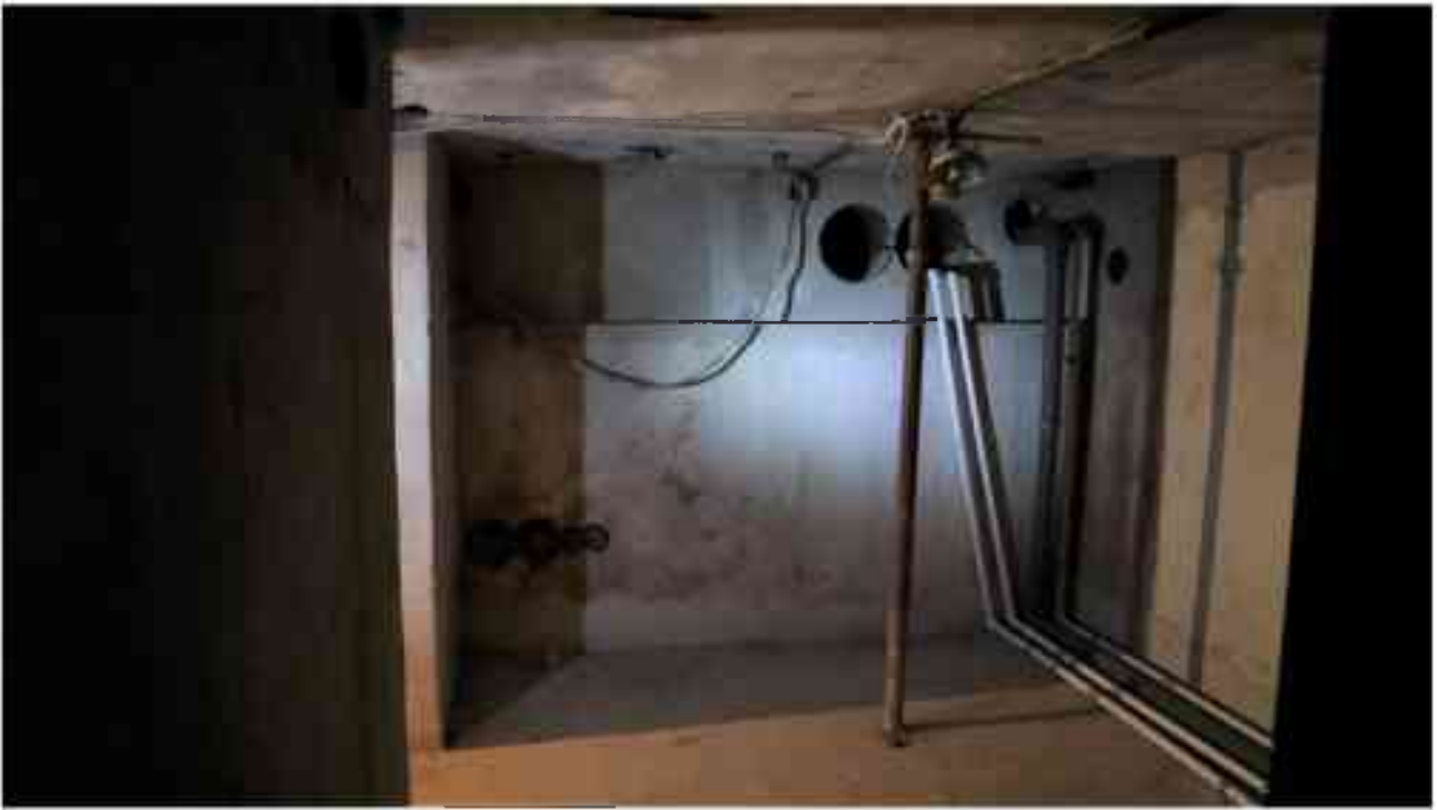
Фото п.15. Подвал, помещение 2Н (4).
