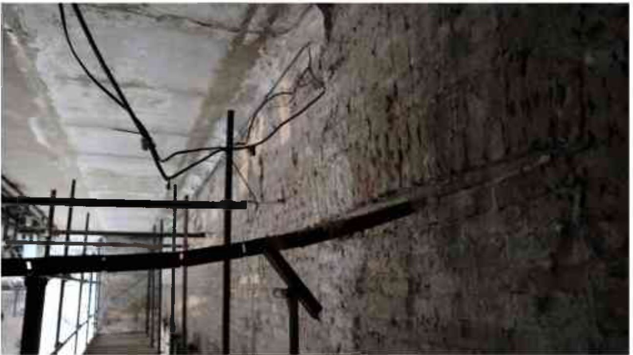
Фото 5.105. 5 этаж, помещение 35Н(3).
