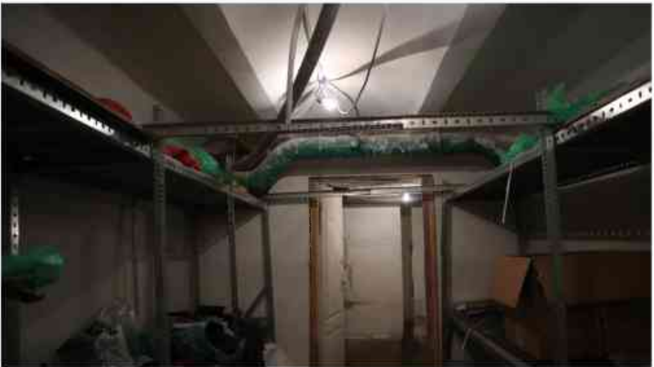
Фото п.117. Подвал, помещение 4Н (10).
