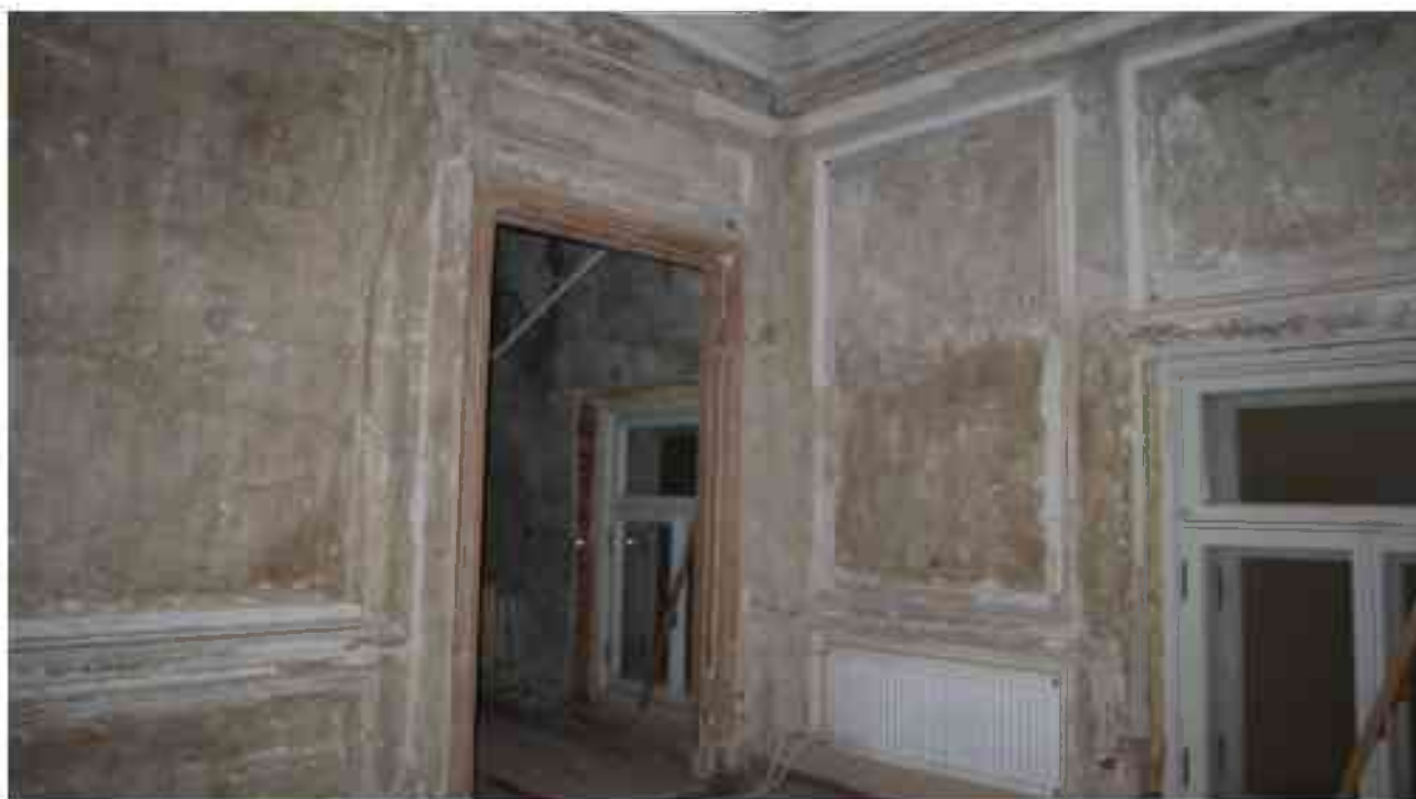
Фото 4.6. 4 этаж, помещение 33Н (39).
