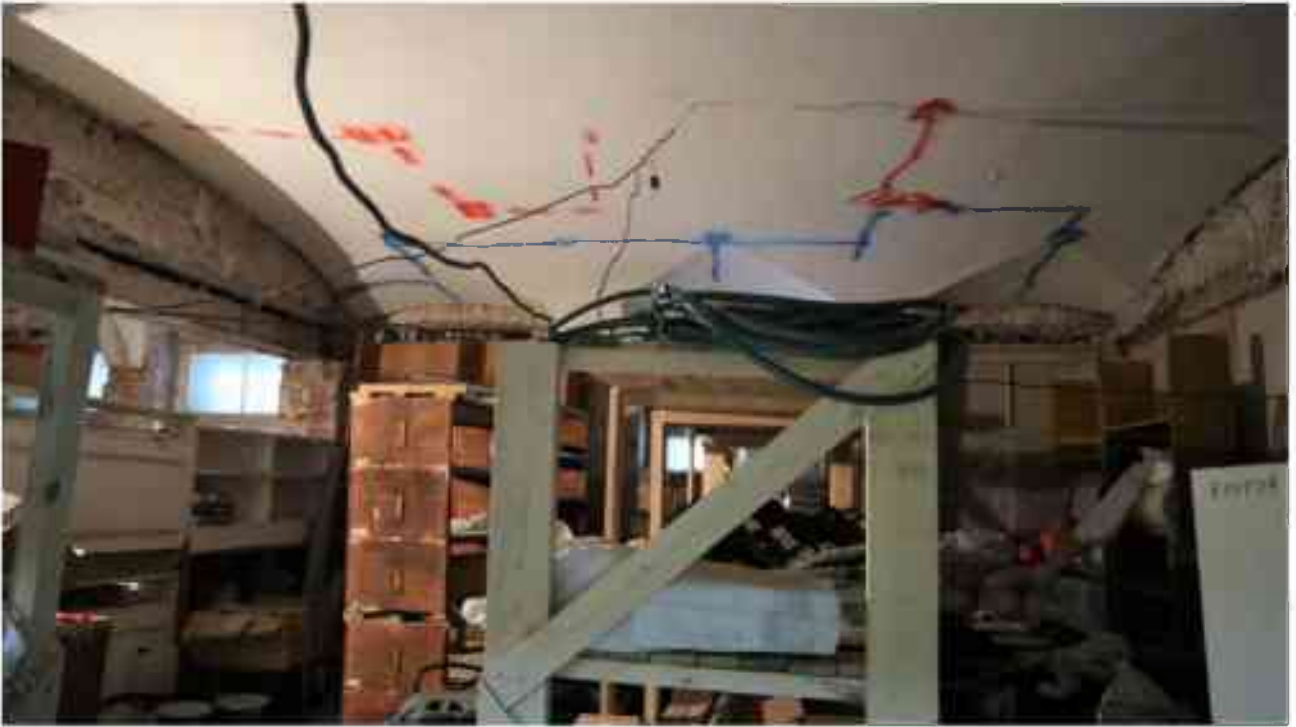
Фото 1.40. 1 этаж, помещение 14Н (6).
