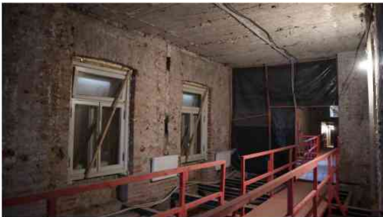
Фото 4.110. 4 этаж, коридор, помещение 29Н (1-2).
