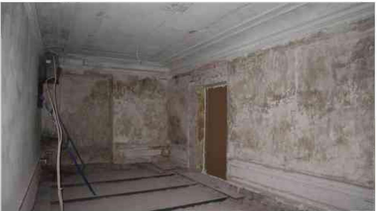
Фото 4.168. 4 этаж, помещение 30Н (7).
