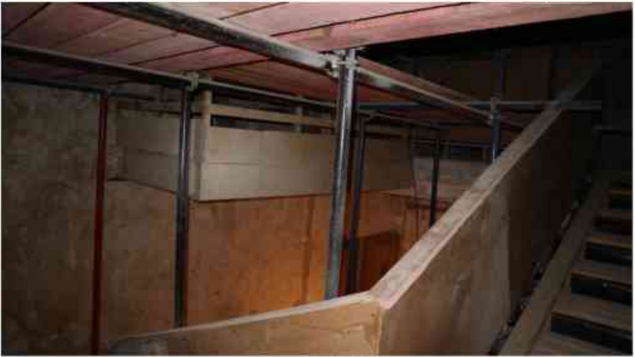
Фото 5.46. 5 этаж, лестница Л-7.
