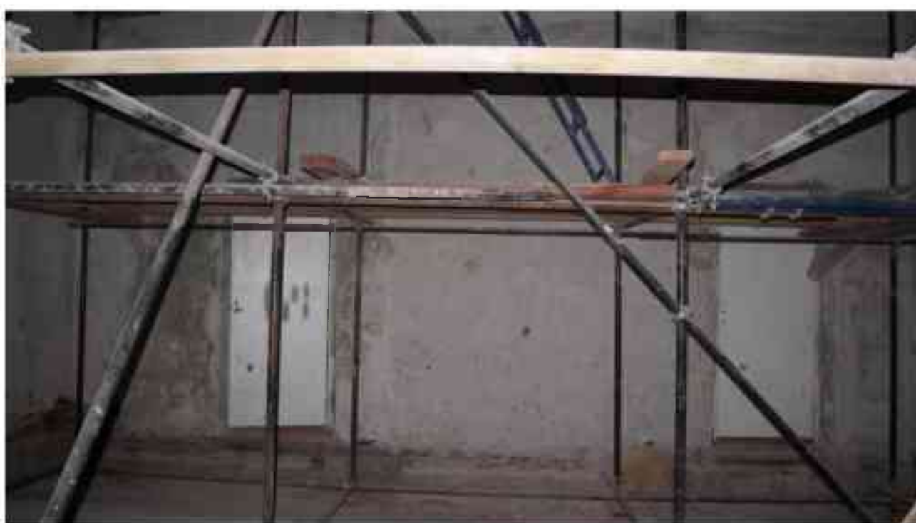
Фото 4.146. 4 этаж, помещение 30Н (12).
