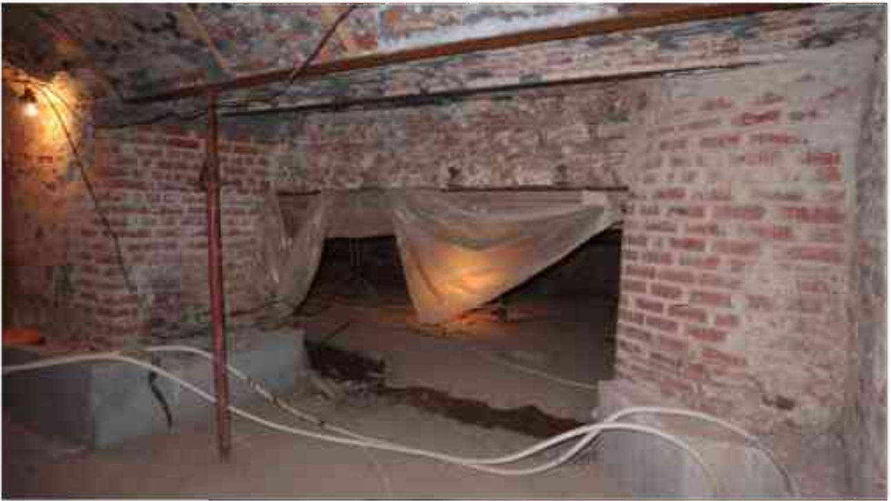
Фото п.292. Подвал, помещение 3Н (17).
