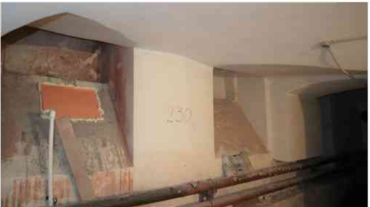
Фото п.99. Подвал, помещение 8Н (8).
