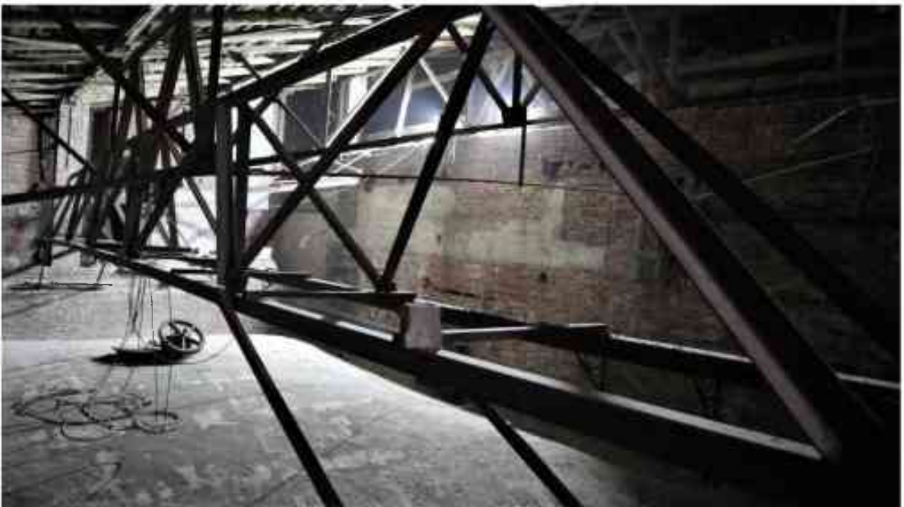
Фото 5.83. 5 этаж, чердачное помещение, купол.
