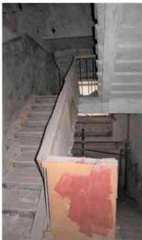
Фото 5.149. 5 этаж, лестница Л-17.
