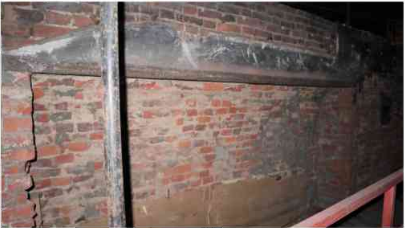
Фото 5.134. 5 этаж, коридор, помещения 34Н/37Н.
