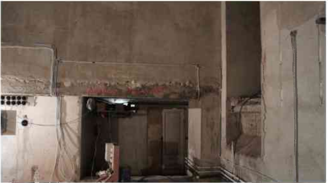
Фото п.59. Подвал, помещение 3Н (15).
