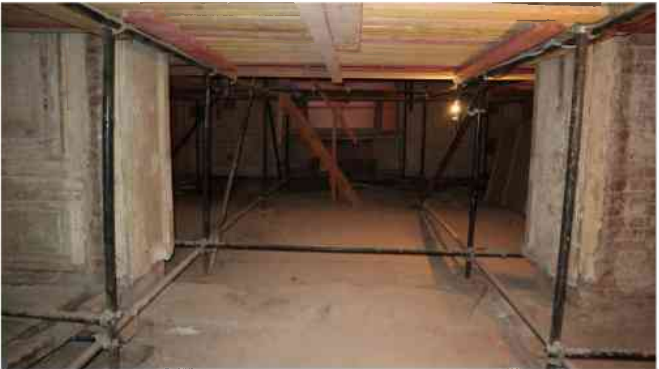
Фото 2.67. 2 этаж, помещение 22Н (29-31).
