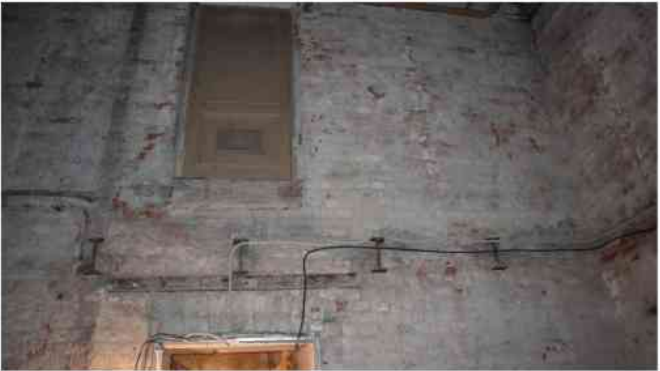
Фото 4.125. 4 этаж, помещение 29Н (5, 10-11).
