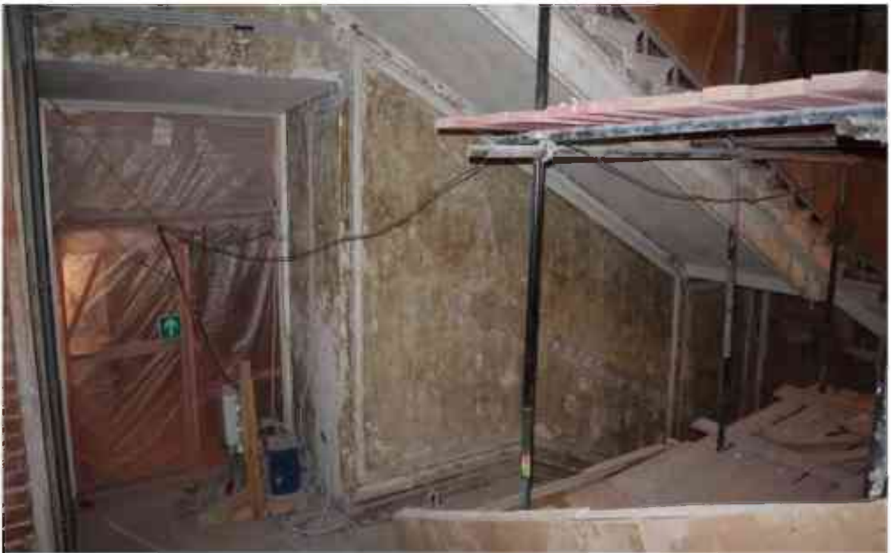
Фото 2.122. 2 этаж, лестница Л-13.
