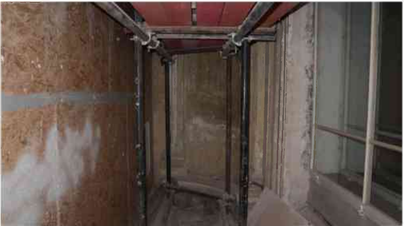
Фото 3.88. 3 этаж, помещение 28Н (2).
