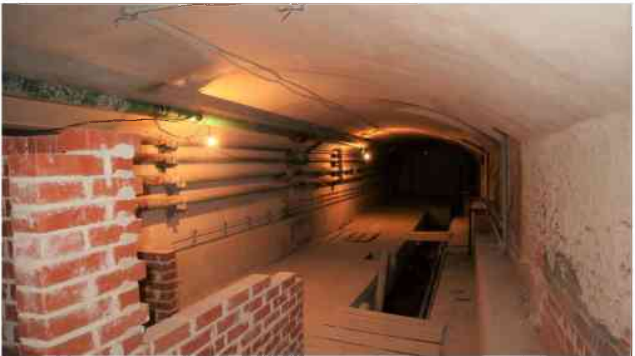
Фото п.187. Подвал, помещение 9Н (21).
