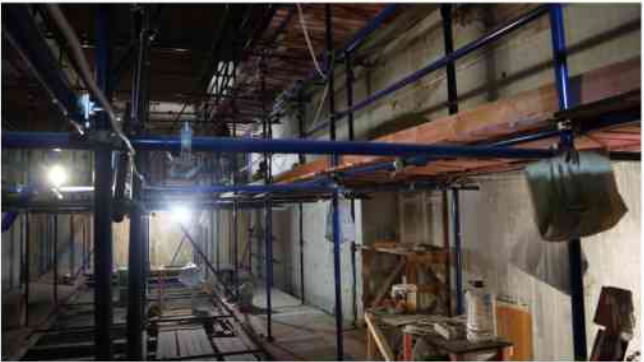
Фото 3.42. 3 этаж, помещение 28Н (20-21).
