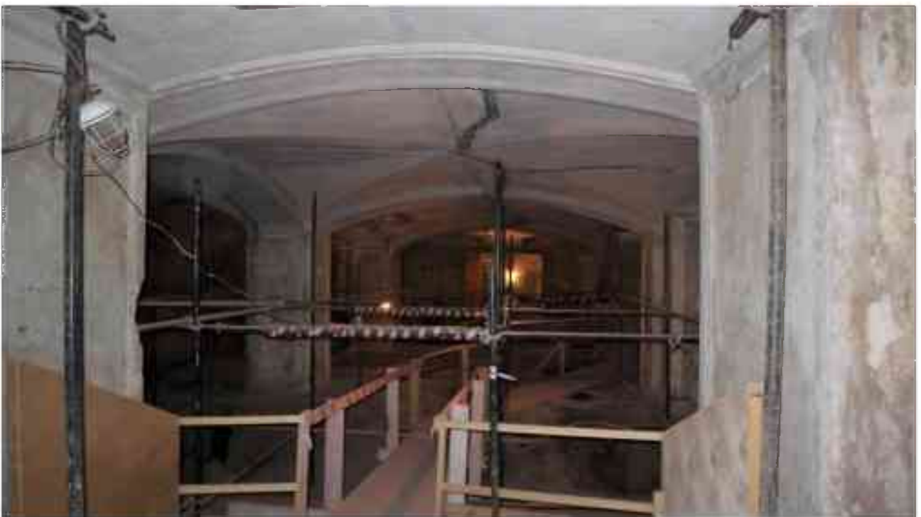
Фото 1.338. 1 этаж, помещение 13Н (4).
