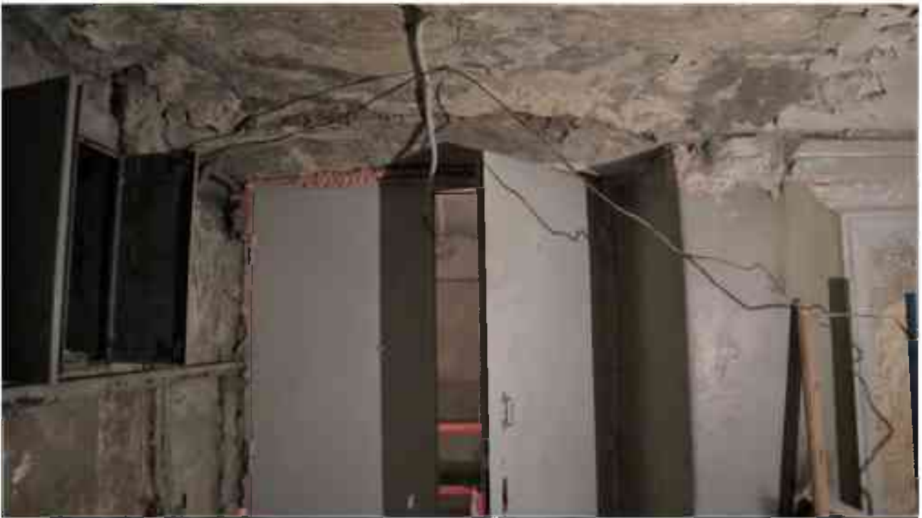
Фото 5.108. 5 этаж, лестница в ризалите южного фасада (западная часть).*
