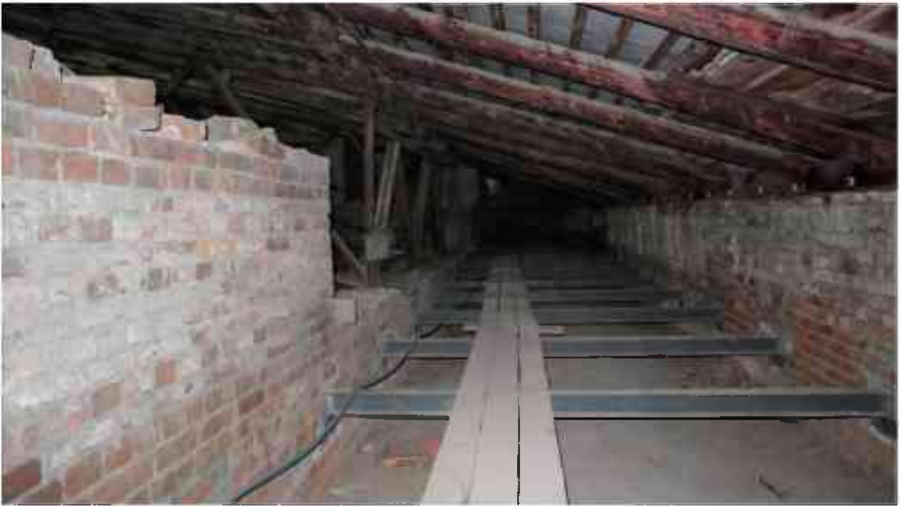
Фото 5.80. 5 этаж, чердачное помещение, купол.
