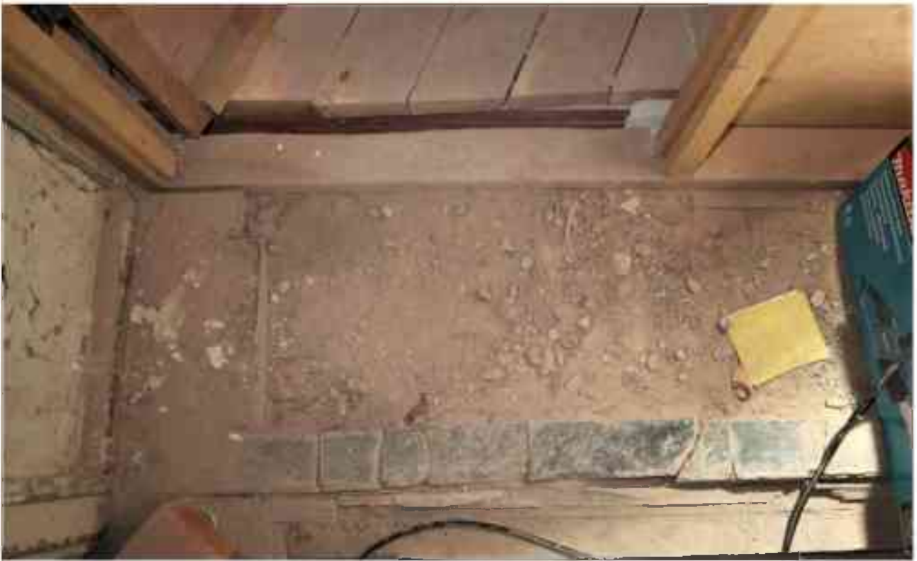
Фото 3.11. 3 этаж, помещение 28Н (26).
