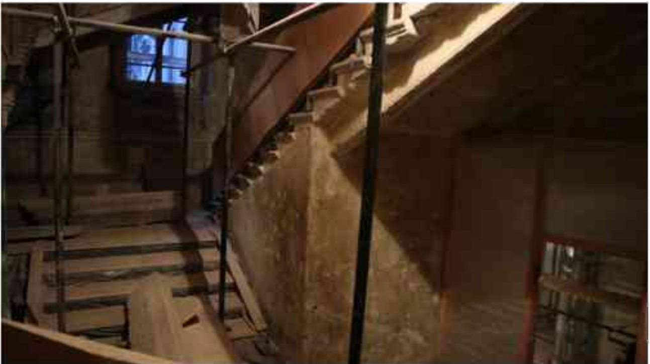
Фото 1.346. 1 этаж, лестница с перекрестными маршами, трехмаршевая, в центре здания.*
