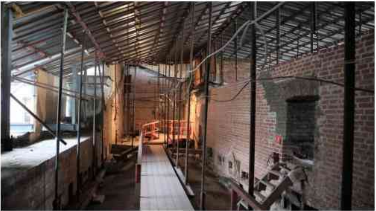
Фото 5.132. 5 этаж, коридор, помещения 34Н/37Н.
