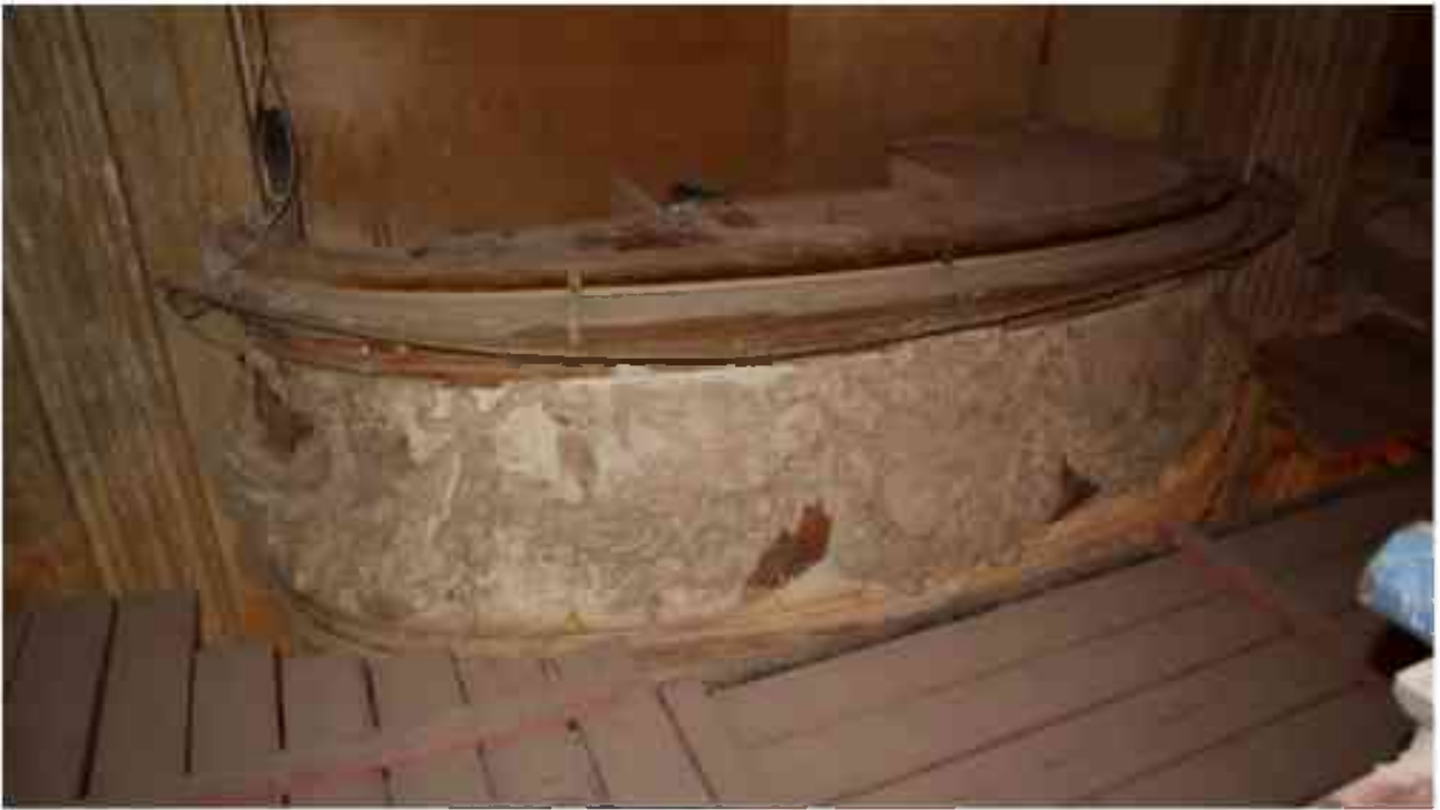
Фото 3.81. 3 этаж, помещение 28Н (2).*
