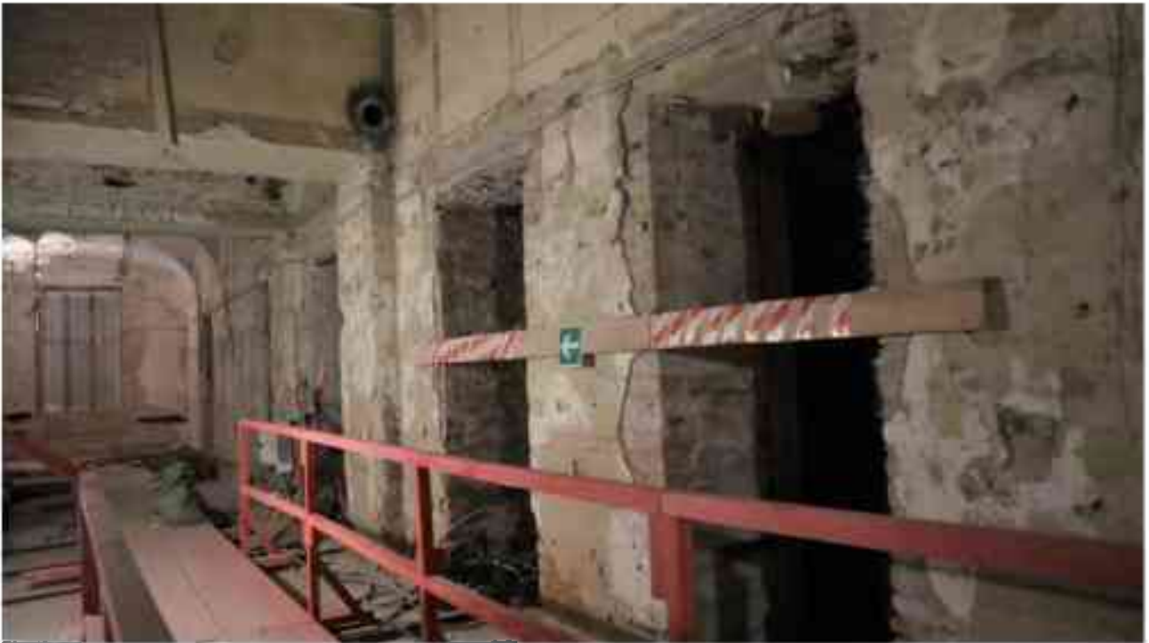
Фото 2.199. 2 этаж, помещение 22Н (10).
