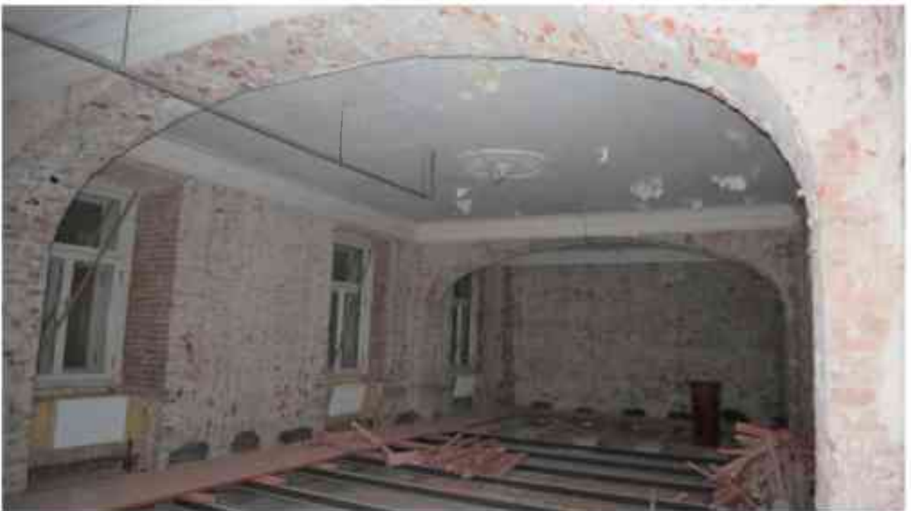
Фото 2.20. 2 этаж, помещение 22Н (48).
