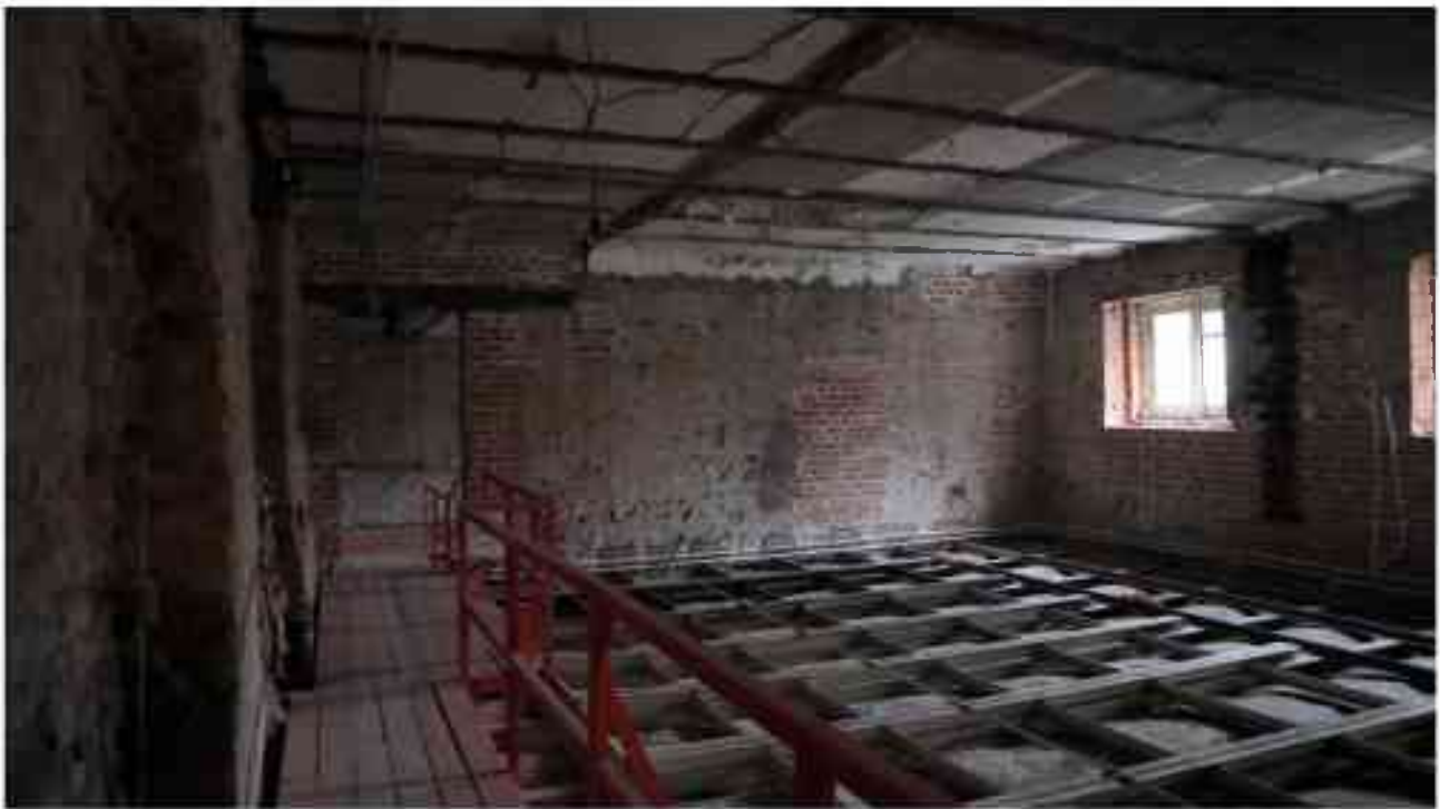
Фото 5.53. 5 этаж, помещение 35Н (12-17).
