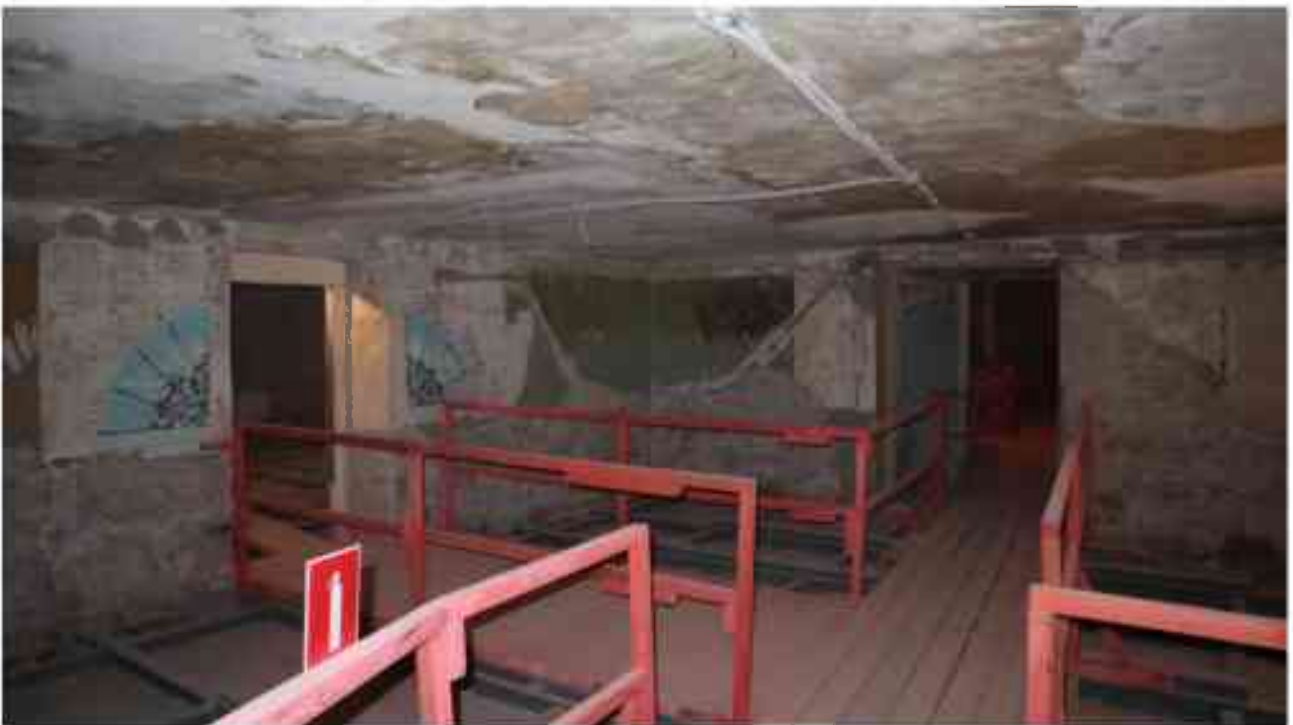
Фото 2.181. 2 этаж, помещение 22Н (11).
