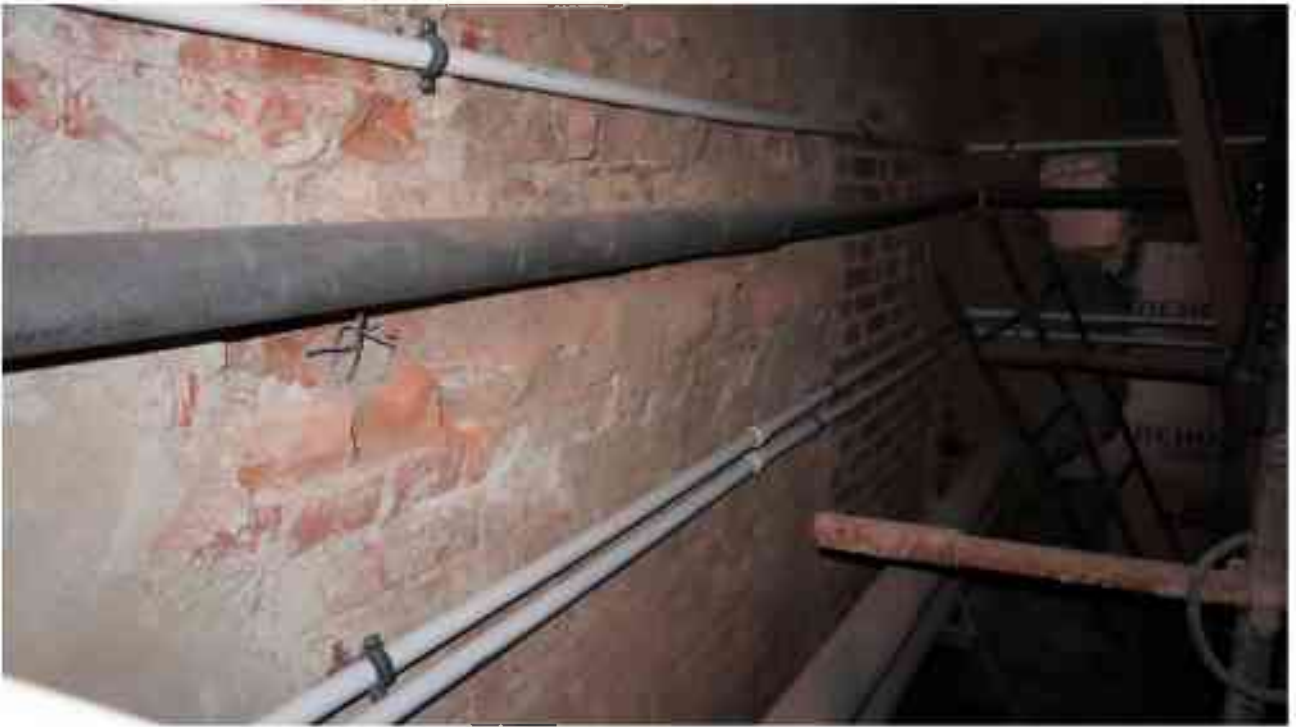
Фото п.77. Подвал, помещение 3Н (2).
