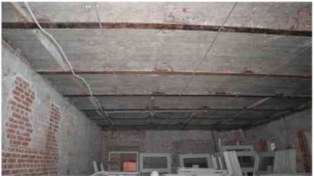
Фото 1.91. 1 этаж, помещение 14Н (36-42).
