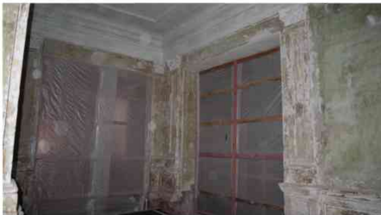
Фото 2.158. 2 этаж, помещение 22Н (20).
