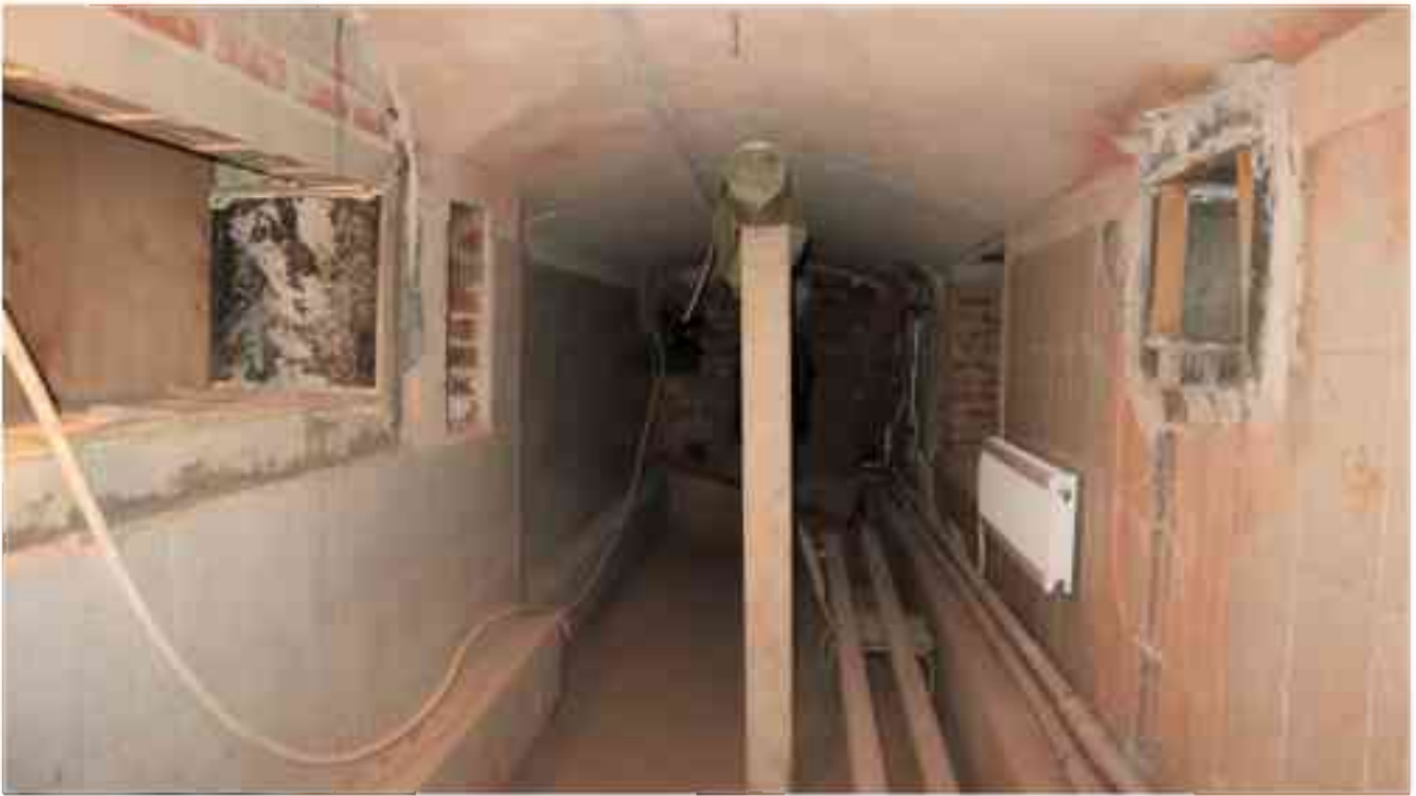
Фото п.276. Подвал, помещение 6Н (8).
