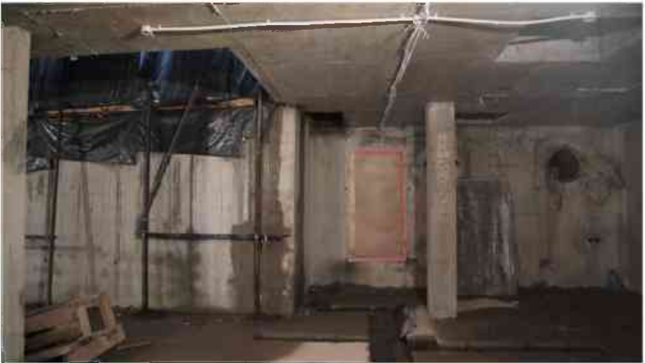
Фото п.242. Подвал, восточного двора.*
