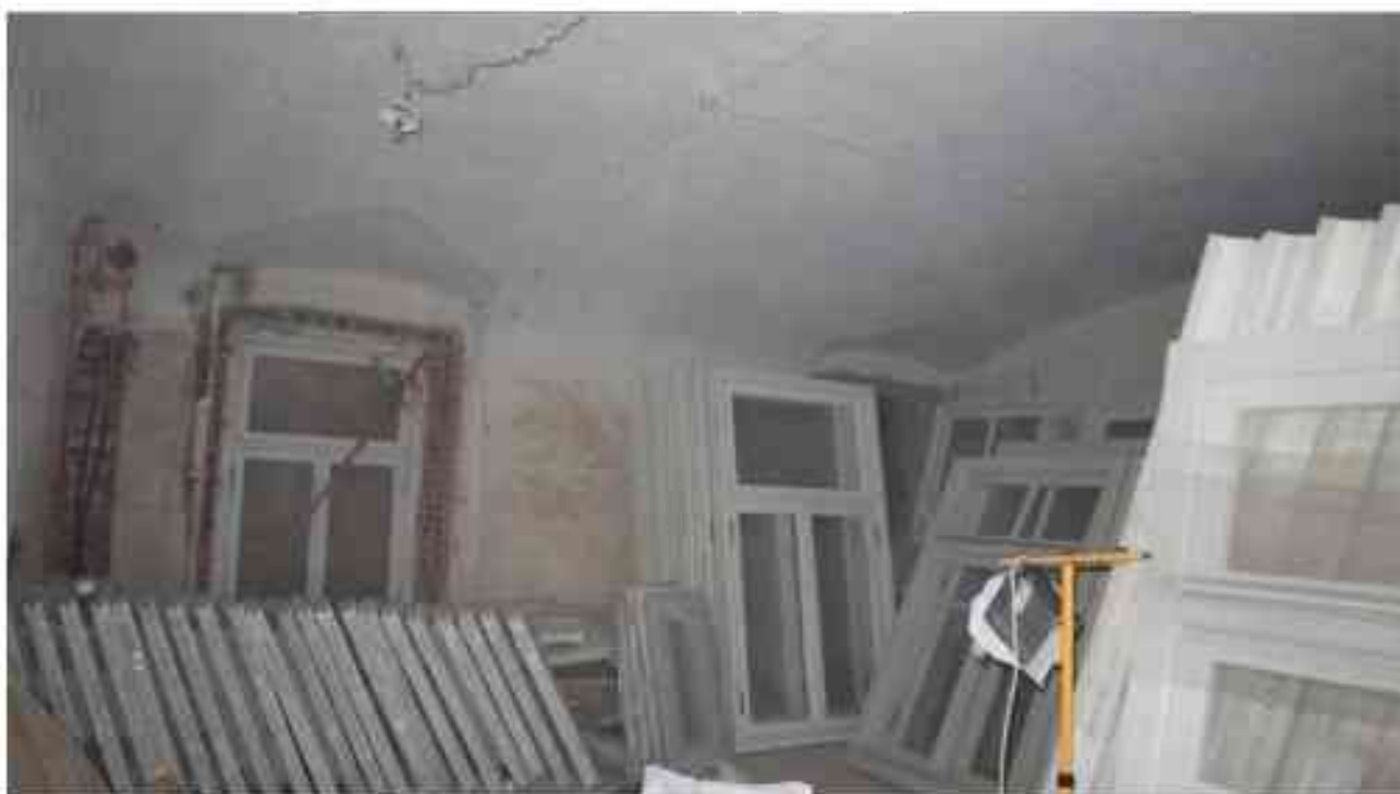
Фото 1.112. 1 этаж, помещение 14Н (30-34).
