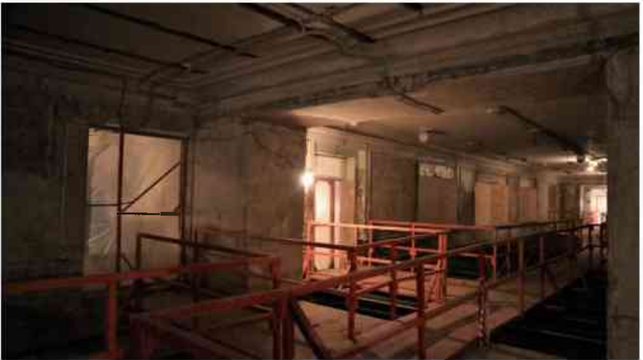
Фото 4.139. 4 этаж, помещение 30Н (5).
