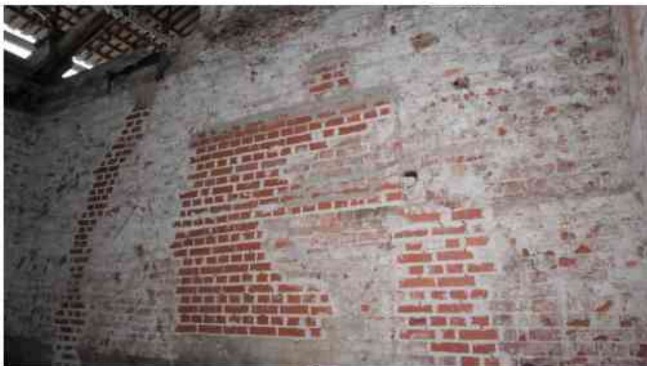
Фото 5.148. 5 этаж, жилой блок, на плане ПИБ 2000г. обозначен как квартиры, помещение (4-6).
