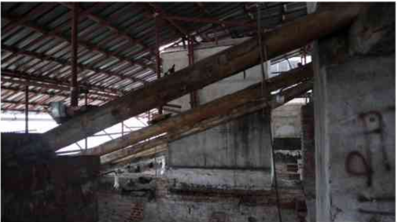
Фото 6.55. 6 этаж, чердачное помещение.
