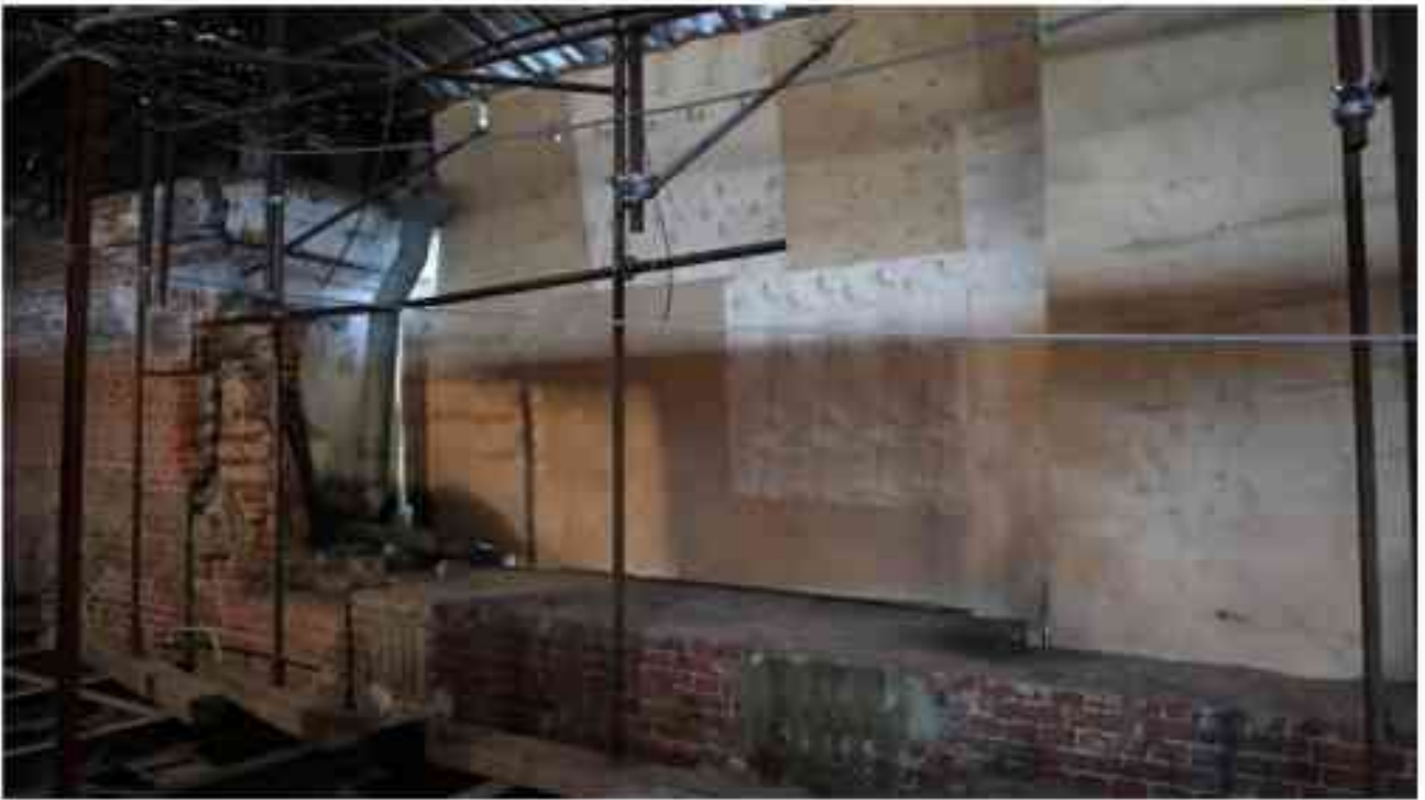
Фото 5.178. 5 этаж, коридор, помещения 34Н/37Н.
