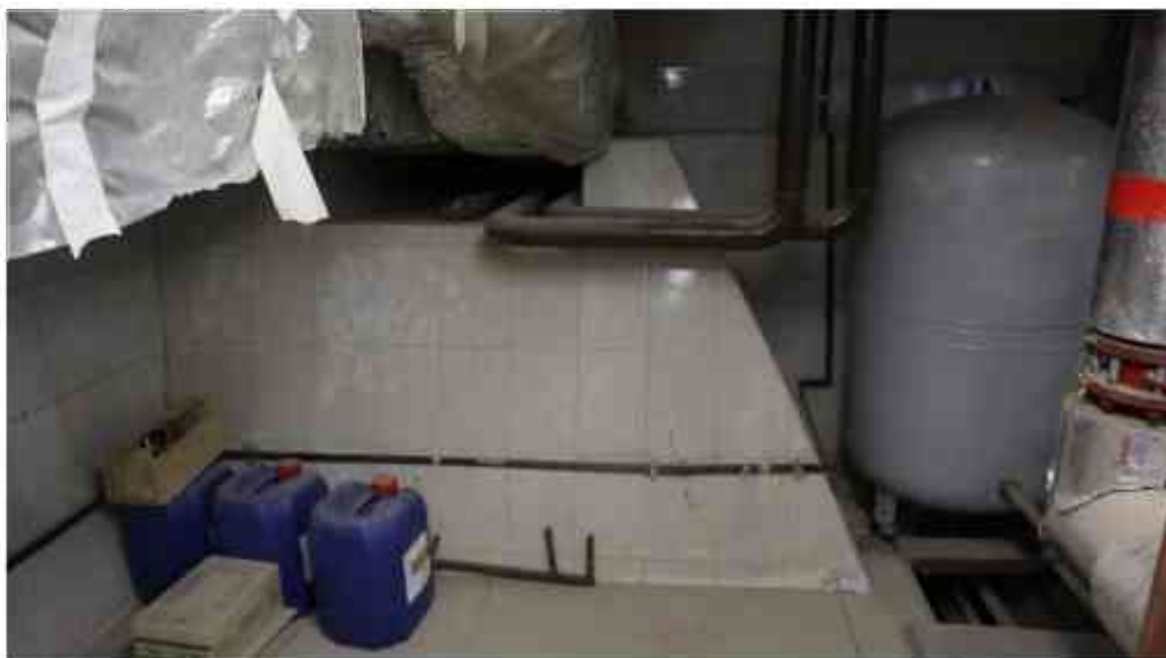
Фото п.328. Подвал, помещение 18Н (10-12).
