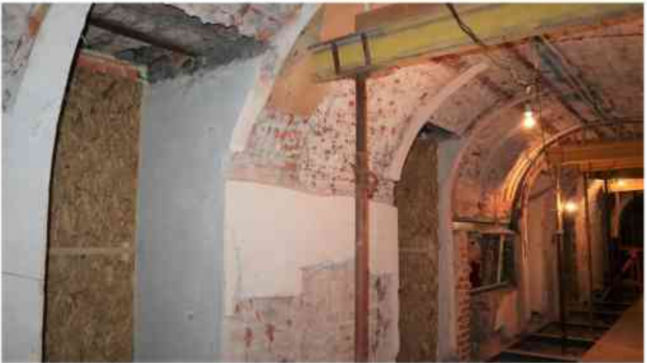
Фото 5.7. 5 этаж, помещение 37Н (1).
