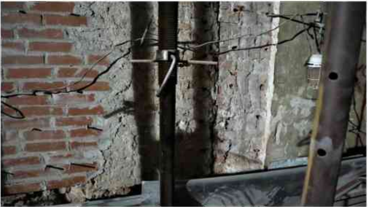
Фото 2.104. 2 этаж, помещение 22Н (33-35, 38-40).
