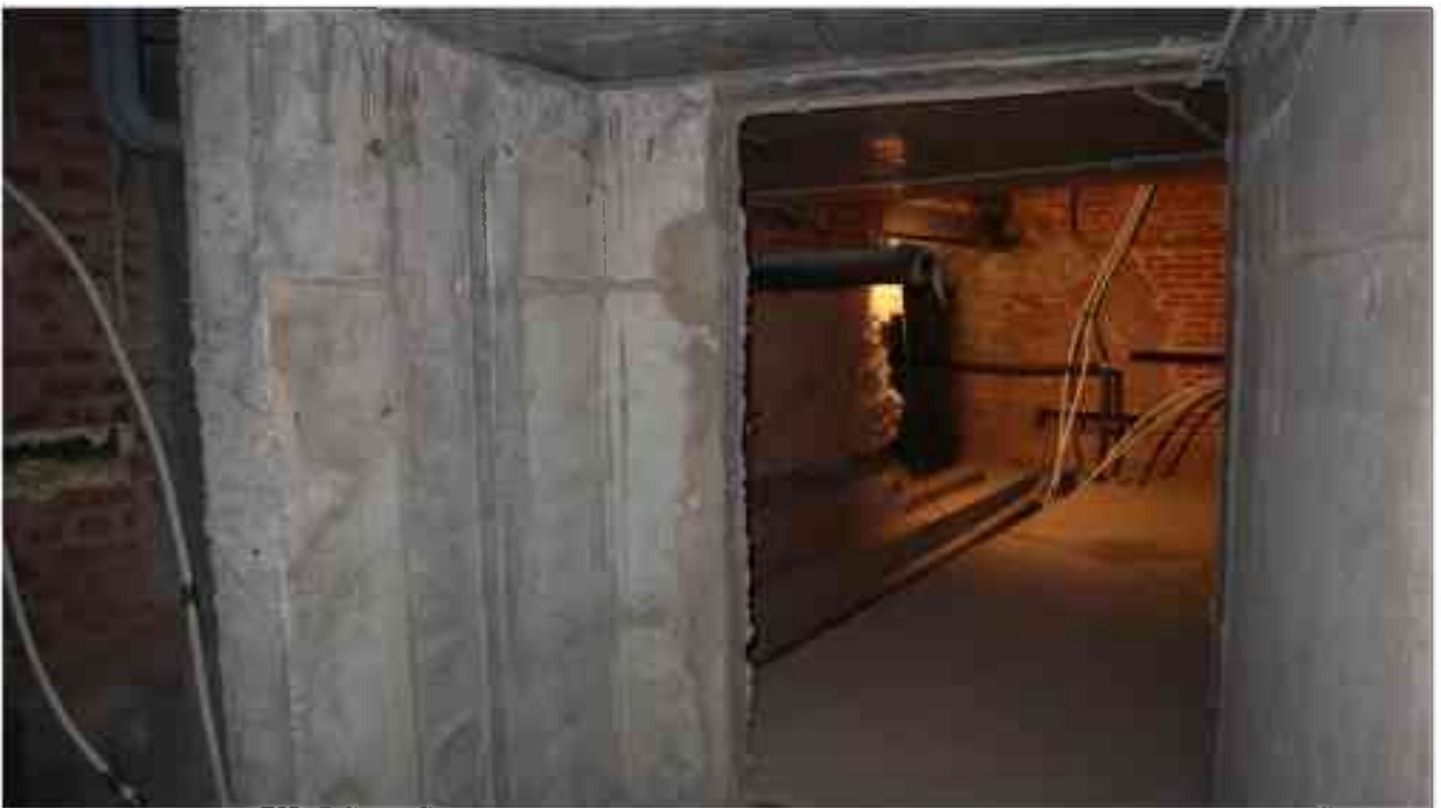
Фото п.41. Подвал, помещение 3Н (12).
