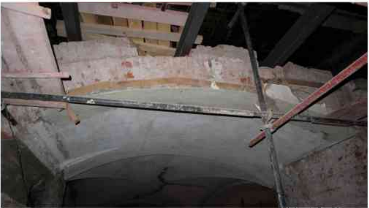
Фото 1.341. 1 этаж, помещение 13Н (32).
