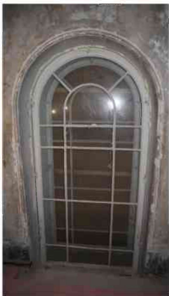
Фото 4.13. 4 этаж, помещение 33Н (38).
