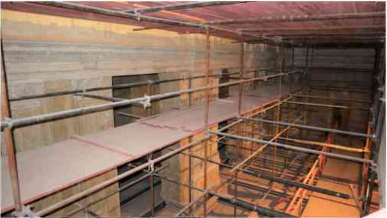
Фото 2.153. 2 этаж, помещение 22Н (19).*
