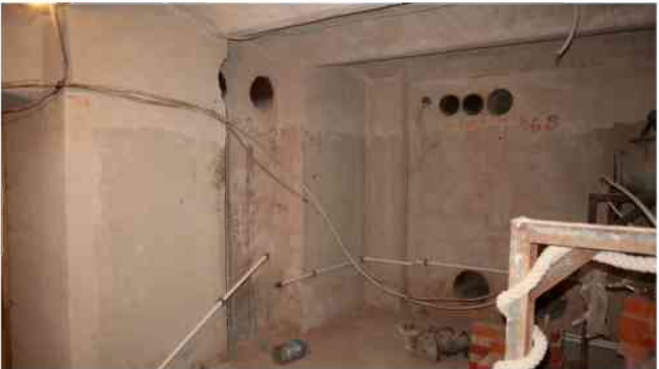
Фото п.10. Подвал, помещение 2Н (2).
