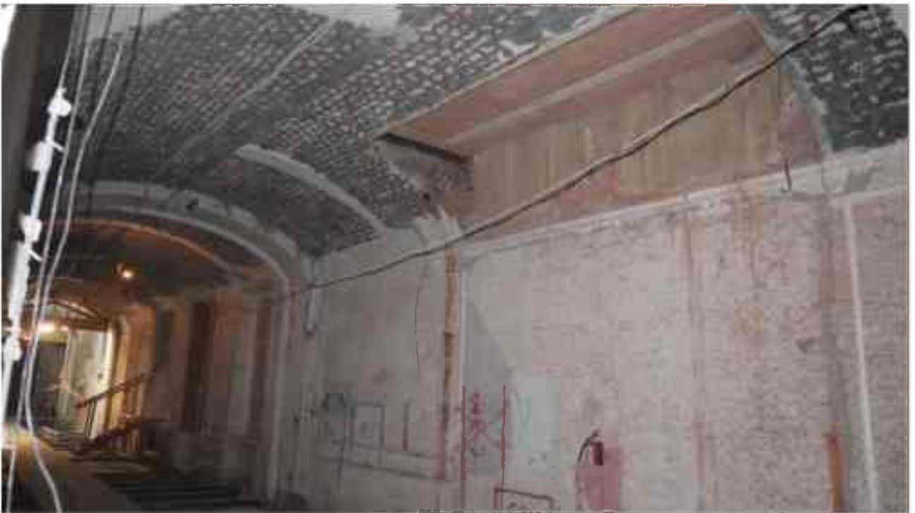
Фото 2.8. 2 этаж, помещение 22Н (66-67).
