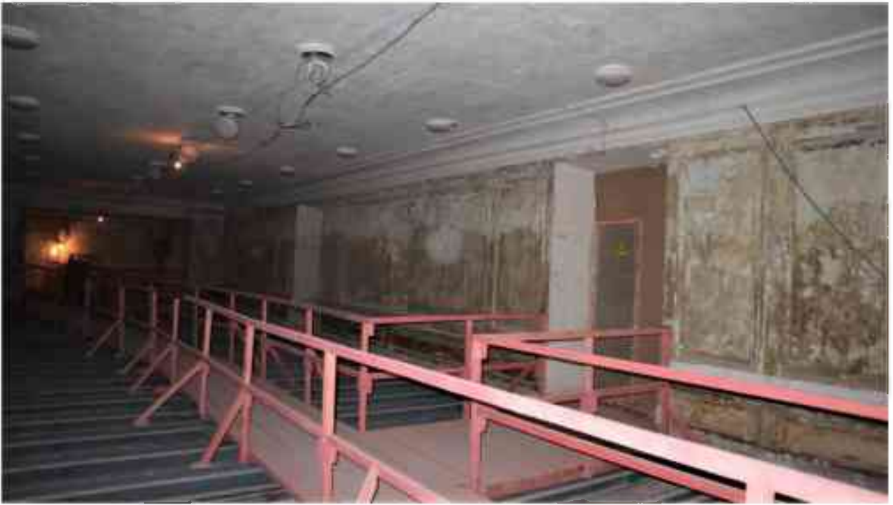
Фото 4.151. 4 этаж, помещение 30Н (5).
