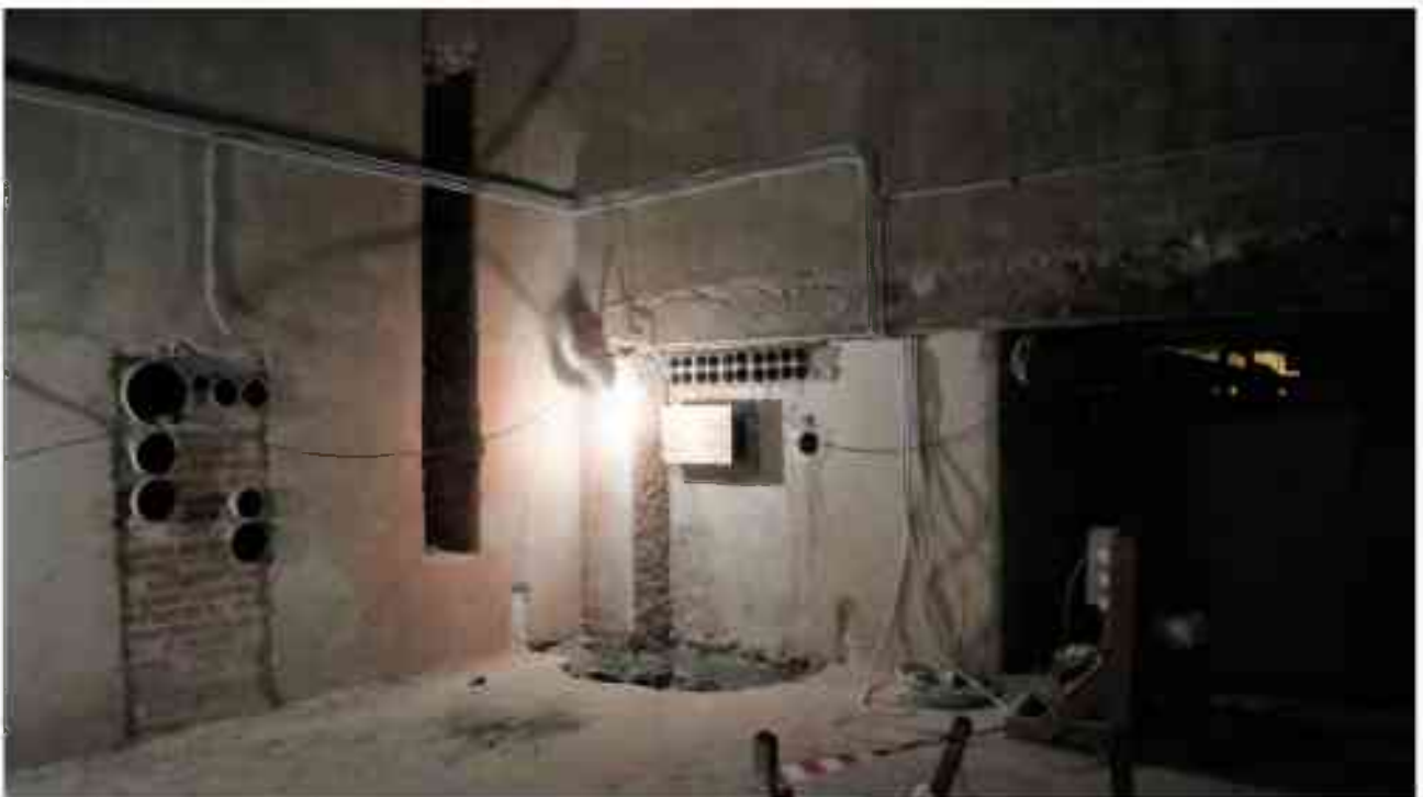
Фото п.58. Подвал, помещение ЗН (15).
