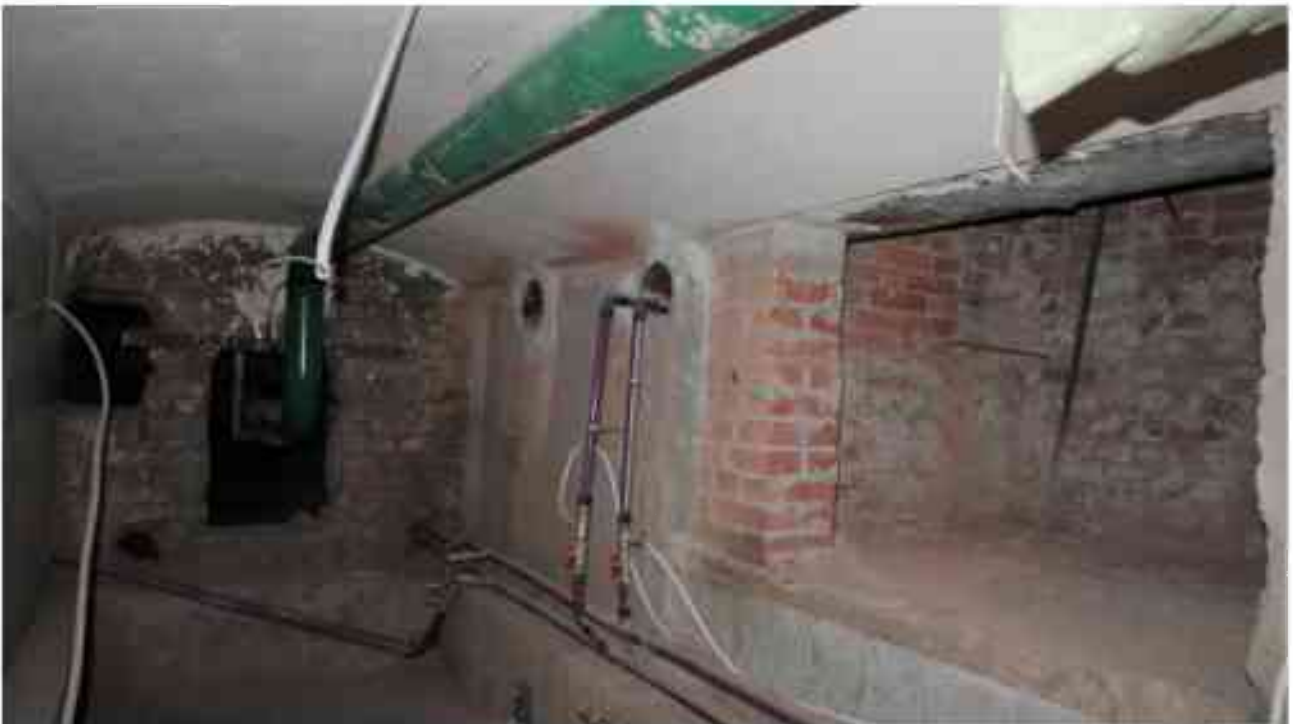
Фото п.277. Подвал, помещение 6Н (8).
