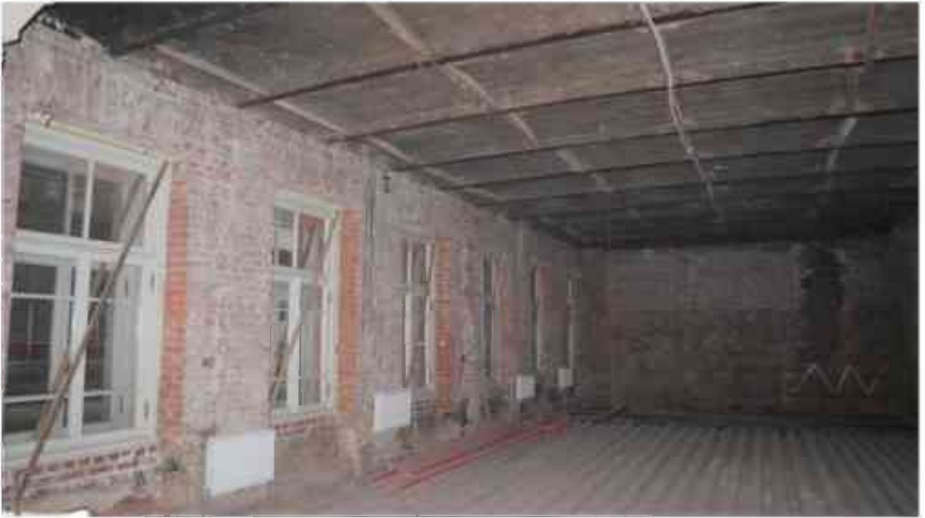
Фото 2.27. 2 этаж, помещение 22Н (68-72, 74-75).
