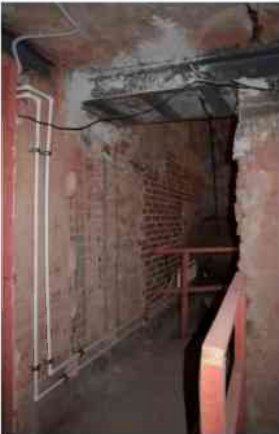
Фото п.65. Подвал, помещение ЗН (1).
