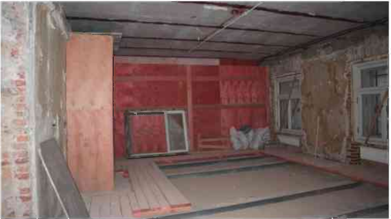
Фото 4.83. 4 этаж, помещение 33Н (5-6).
