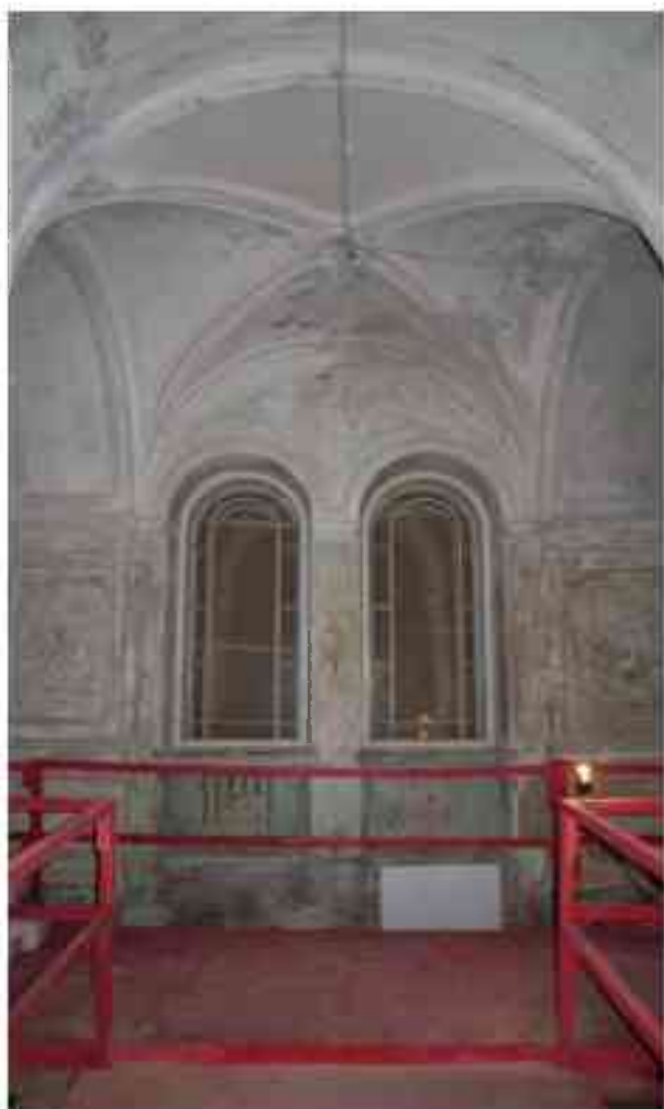
Фото 4.155. 4 этаж, помещение 30Н (4).
