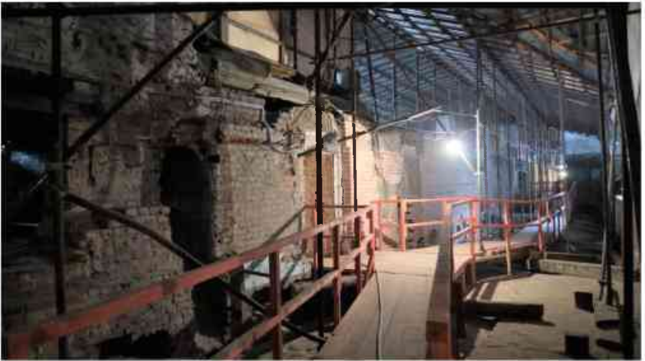
Фото 5.120. 5 этаж, коридор, помещения 34Н/37Н.
