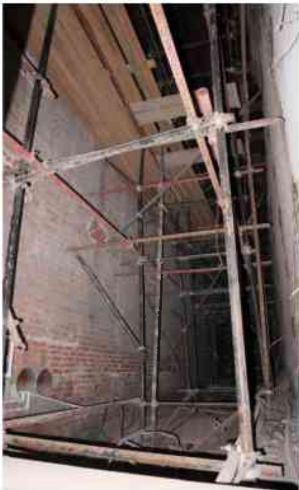
Фото п.78. Подвал, помещение 3Н (4).
