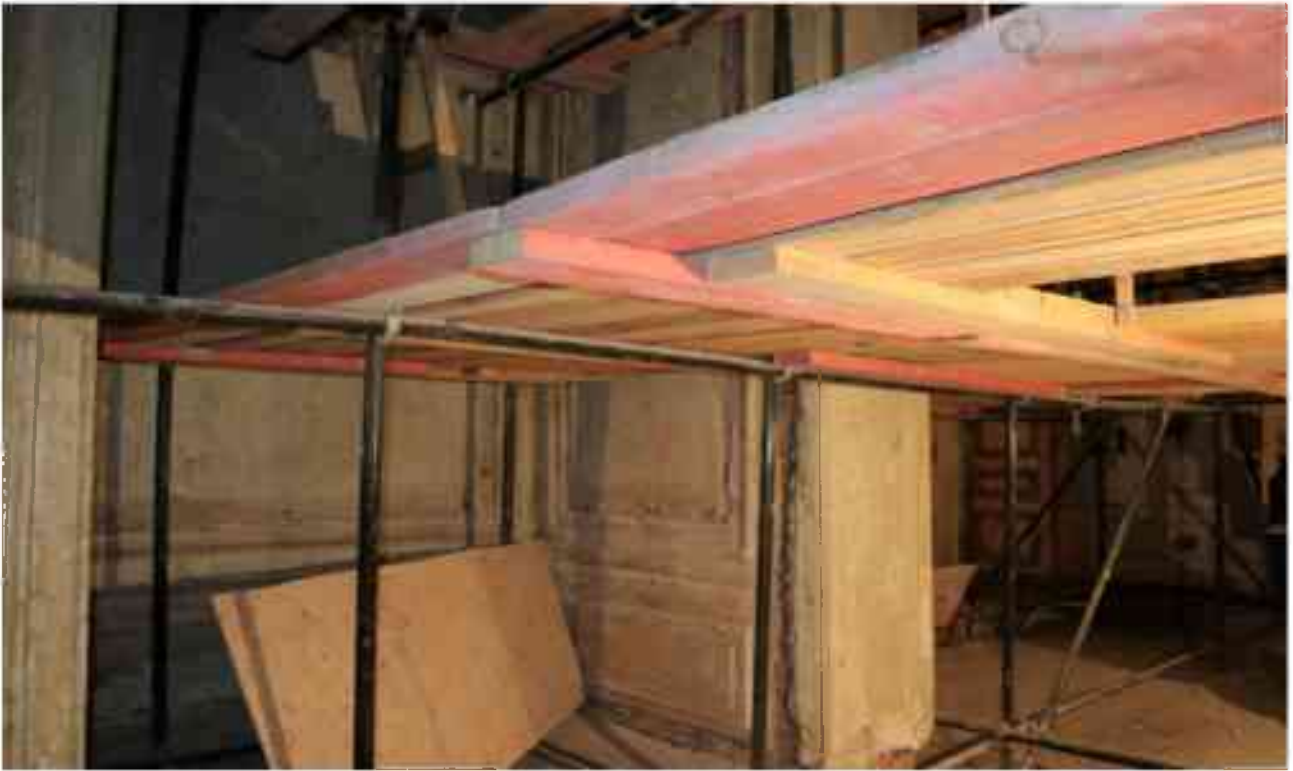
Фото 2.66. 2 этаж, помещение 22Н (29-30).
