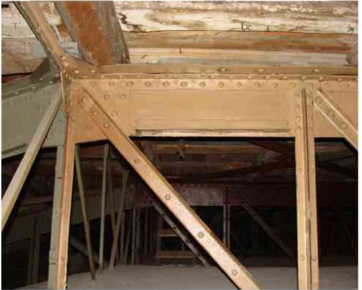
Ил. 230. Здание С.-Петербургской Консерватории им. Н. А. Римского-Корсакова. Исторические металлические фермы над зрительным залом. (1912 г. ?) Фото 2012 года.
