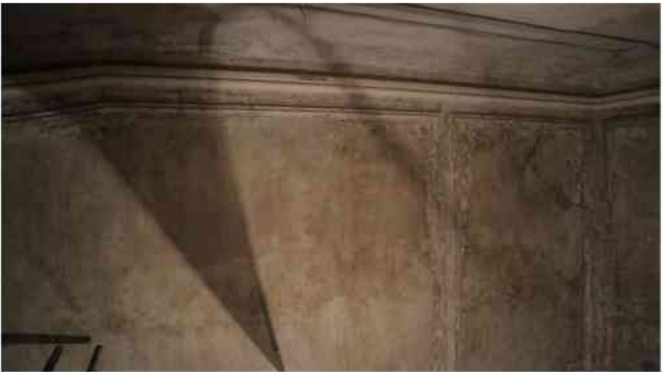
Фото 5.111. 5 этаж, лестница Л-10.
