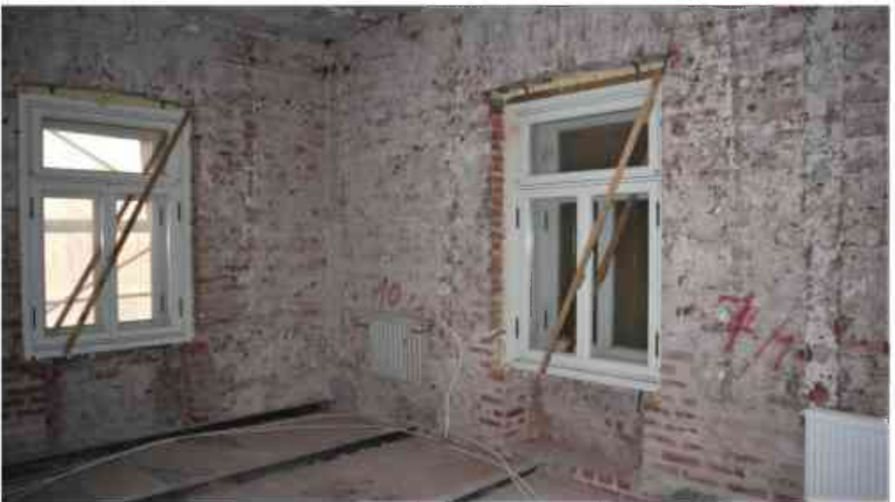
Фото 4.112. 4 этаж, коридор, помещение 29Н (1-2).
