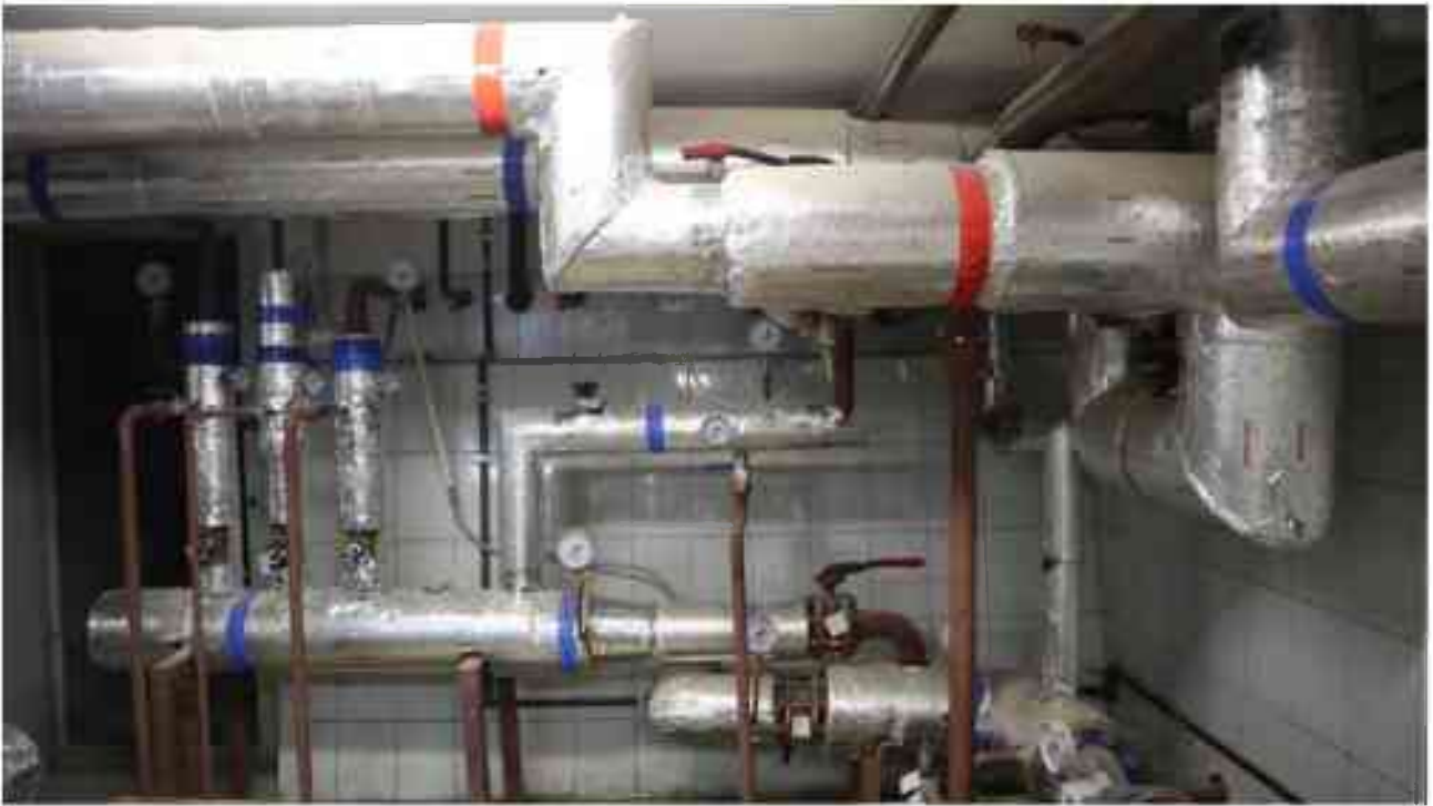
Фото п.326. Подвал, помещение 18Н (10-12).
