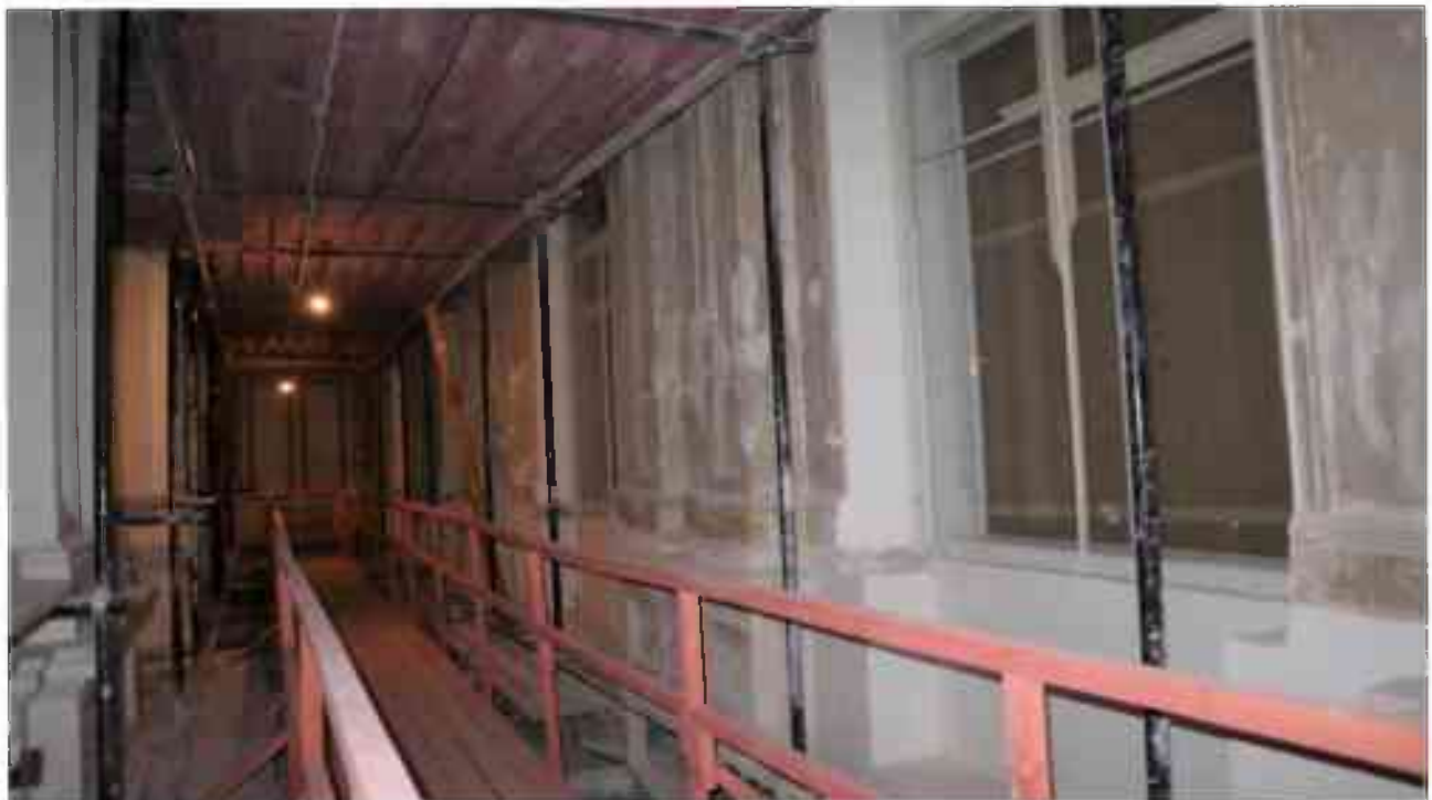
Фото 2.125. 2 этаж, помещение 22Н (19).
