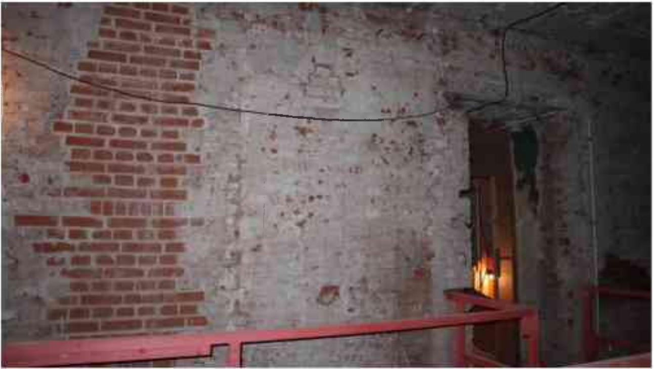
Фото 4.113. 4 этаж, коридор, помещение 29Н (1-2).
