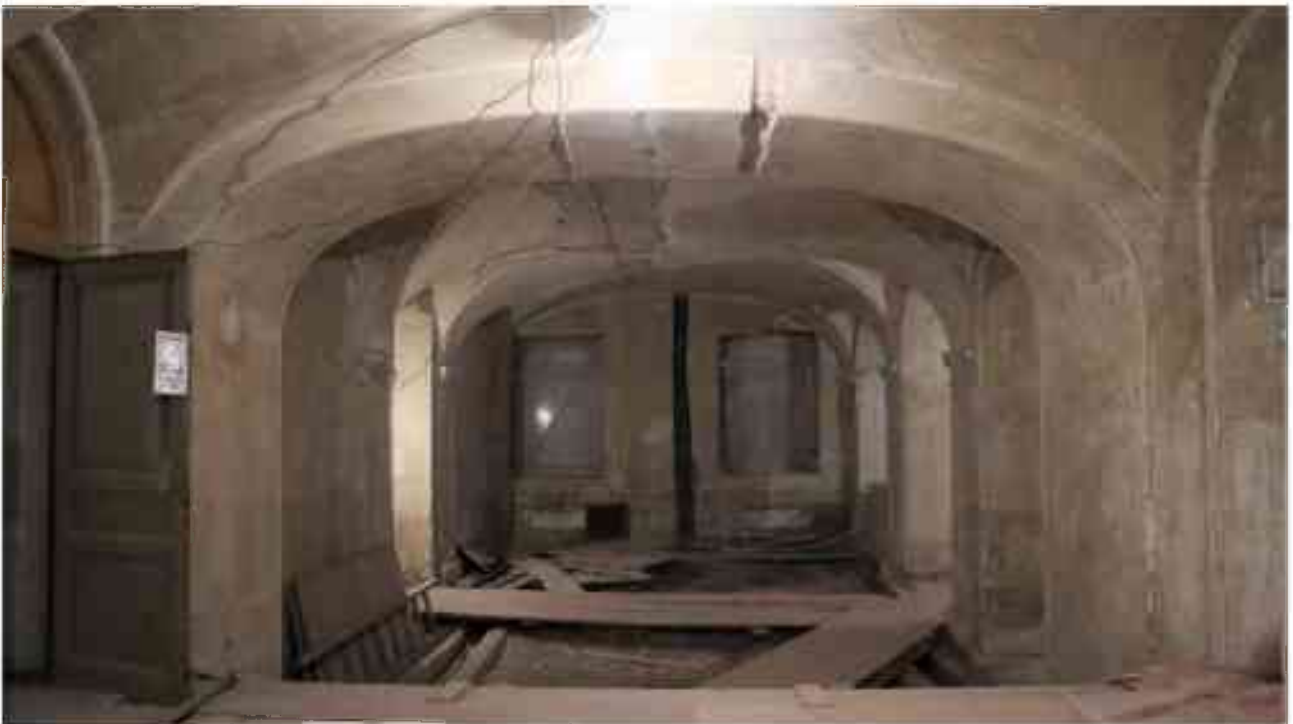
Фото 1.151. 1 этаж, помещение 31Н (1).
