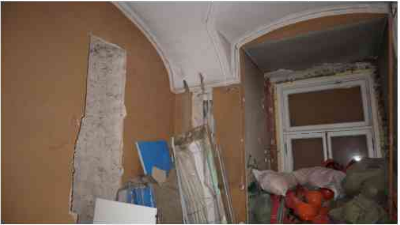
Фото 1.133. 1 этаж, западная часть помещения 31Н (7).
