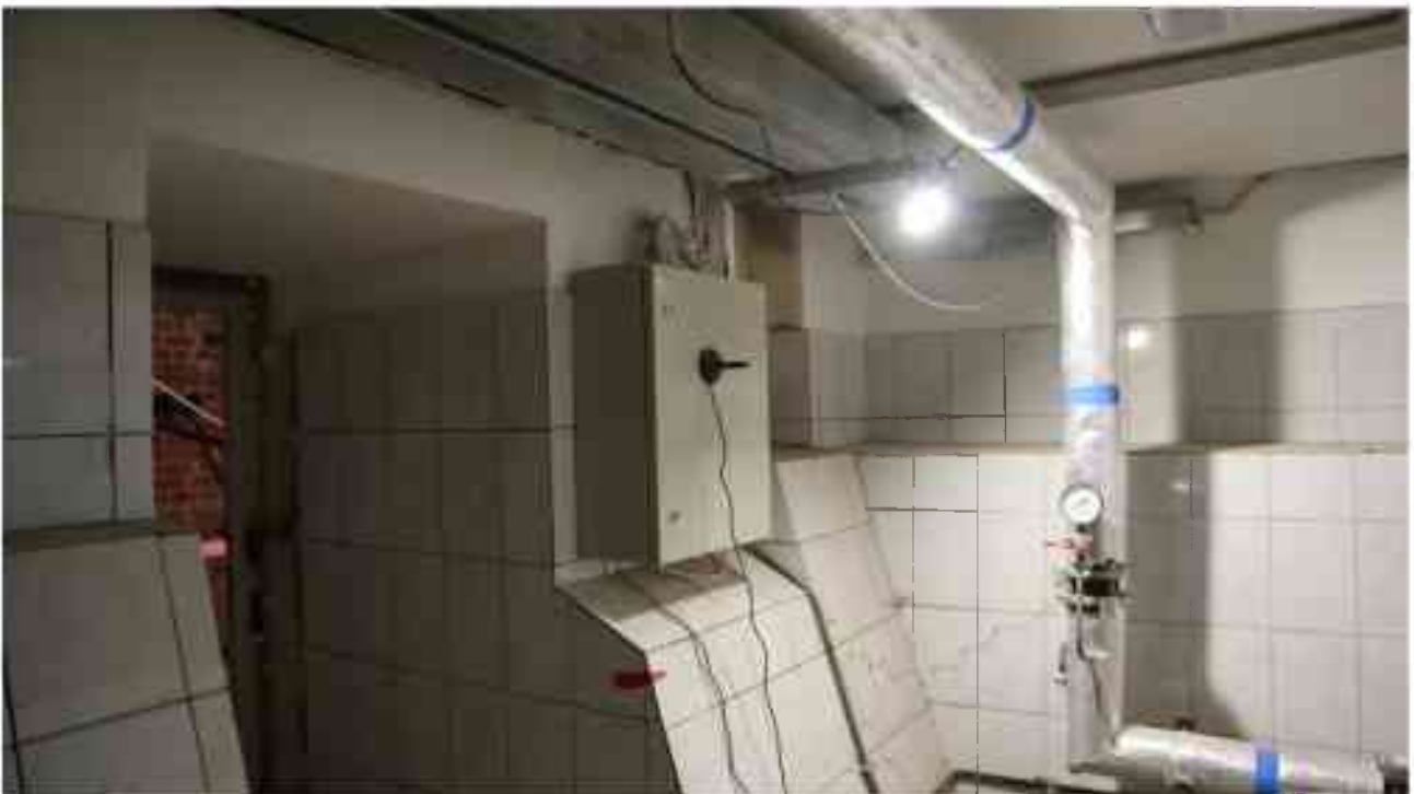
Фото п.321. Подвал, помещение 18Н (1-2, 8).
