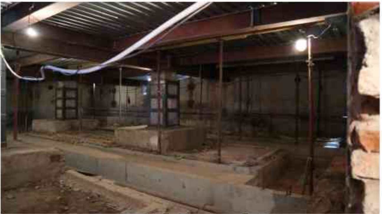
Фото п.25. Подвал, помещение 3Н (5).
