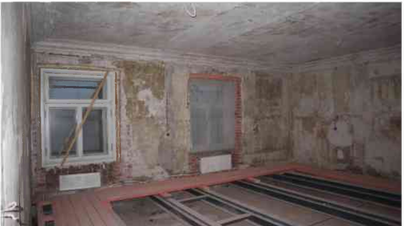
Фото 4.92. 4 этаж, помещение 33Н (11).
