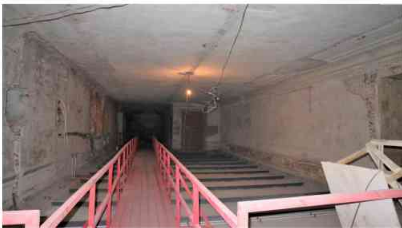
Фото 4.164. 4 этаж, помещение 30Н (7).
