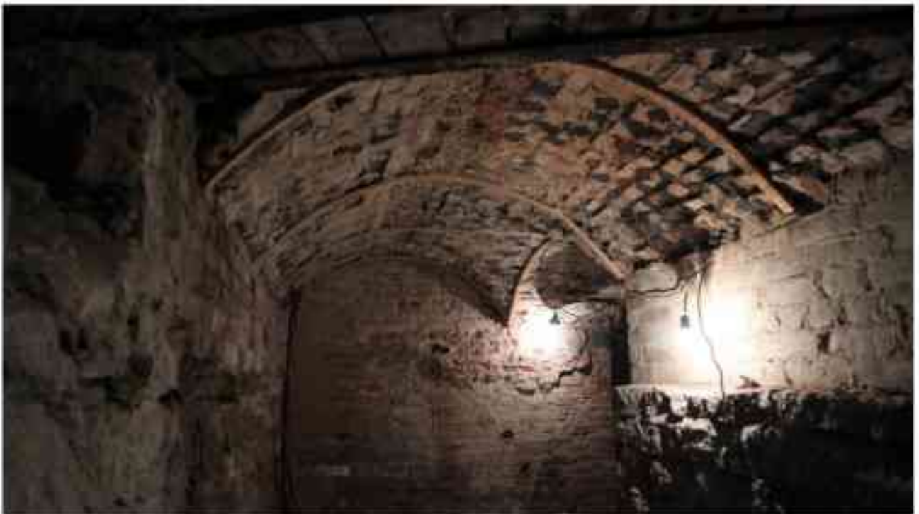
Фото п.288 Подвал, помещение 3Н (17).
