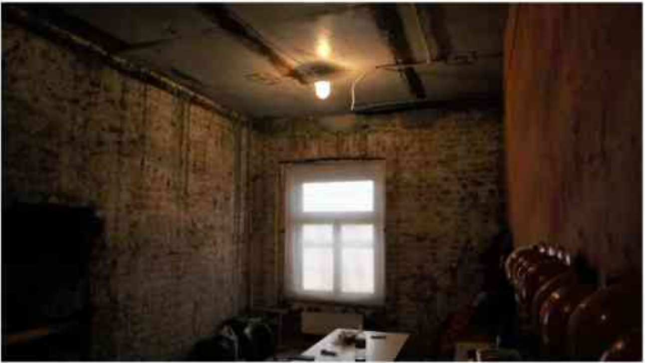
Фото 4.81. 4 этаж, помещение 33Н (4).
