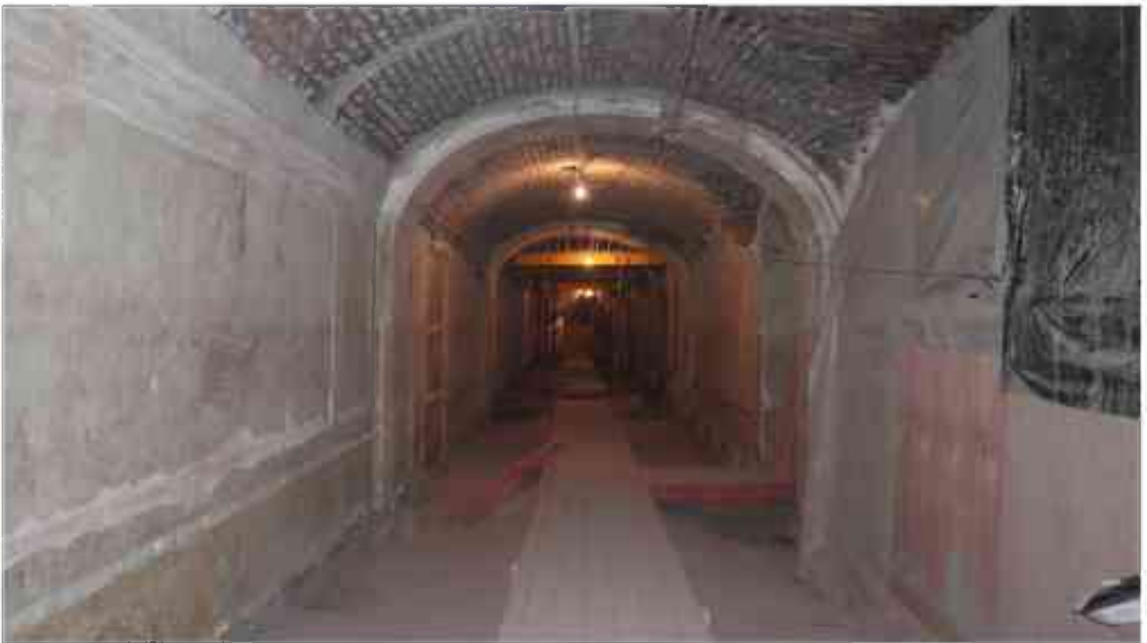
Фото 4.41. 4 этаж, коридор, помещение 33Н (22).
