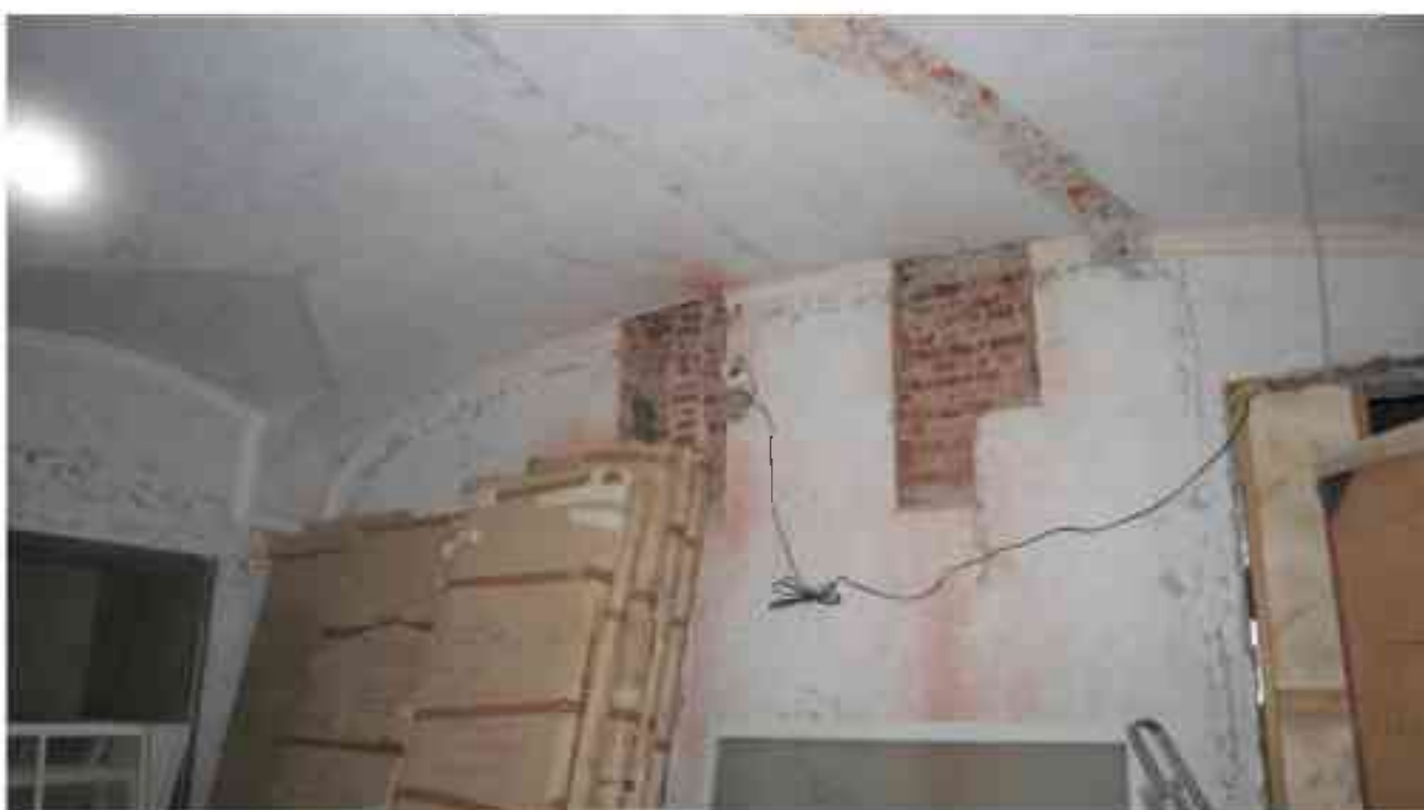
Фото 1.72. 1 этаж, помещение 14Н (21).
