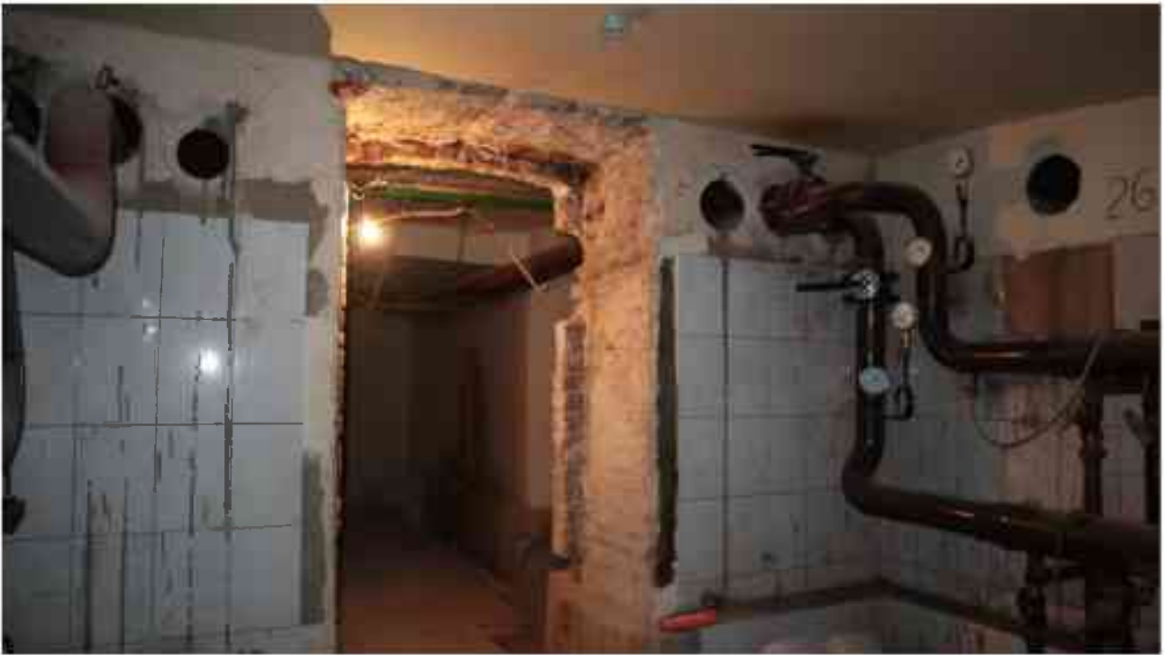
Фото п.168. Подвал, помещение 9Н (10).
