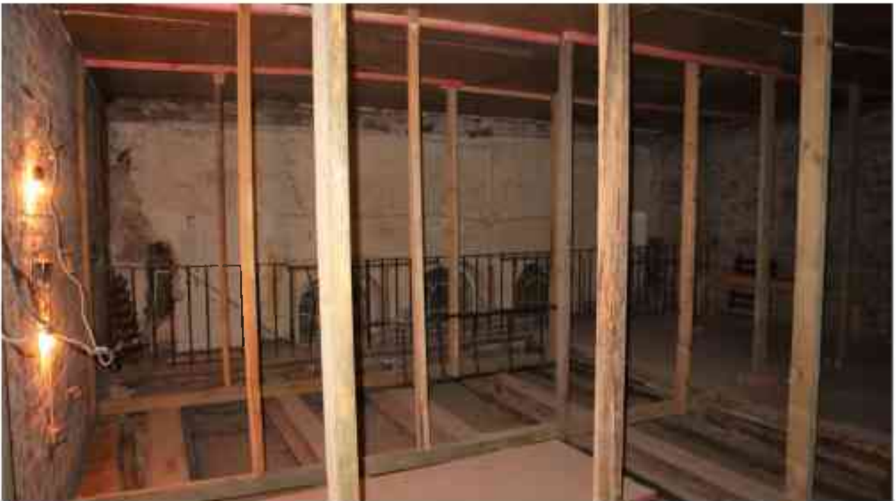
Фото 4.180. 4 этаж, помещение 32Н (1-2).
