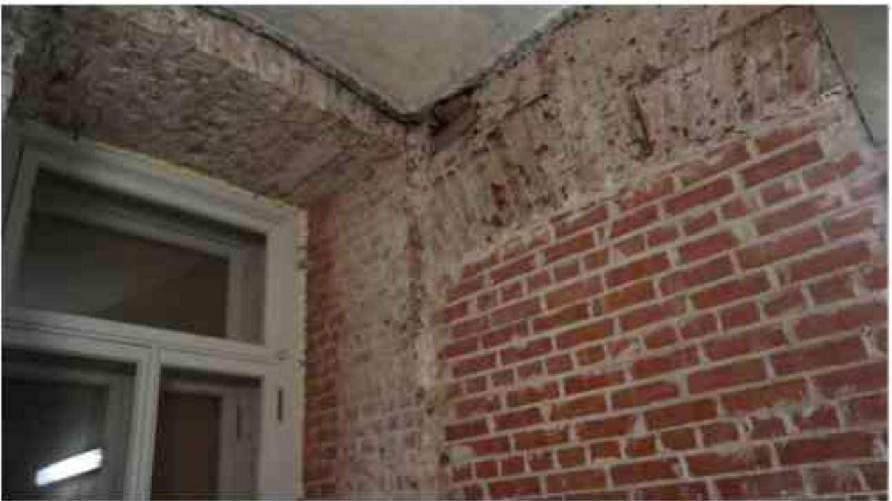
Фото 2.18. 2 этаж, помещение 22Н (47).
