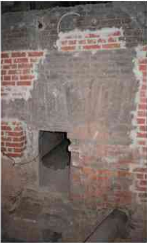
Фото 5.128. 5 этаж, коридор, помещения 34Н/37Н.
