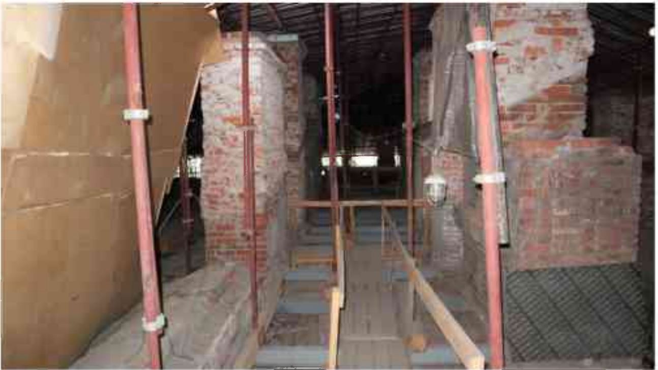
Фото 6.31. 6 этаж, чердачное помещение.
