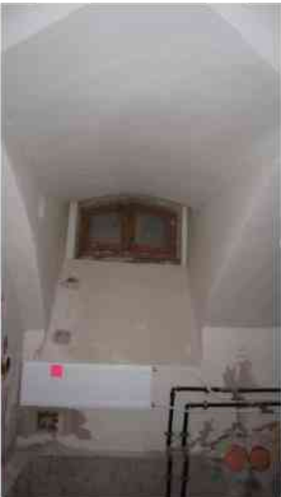
Фото п.215. Подвал, помещение 9Н (4).
