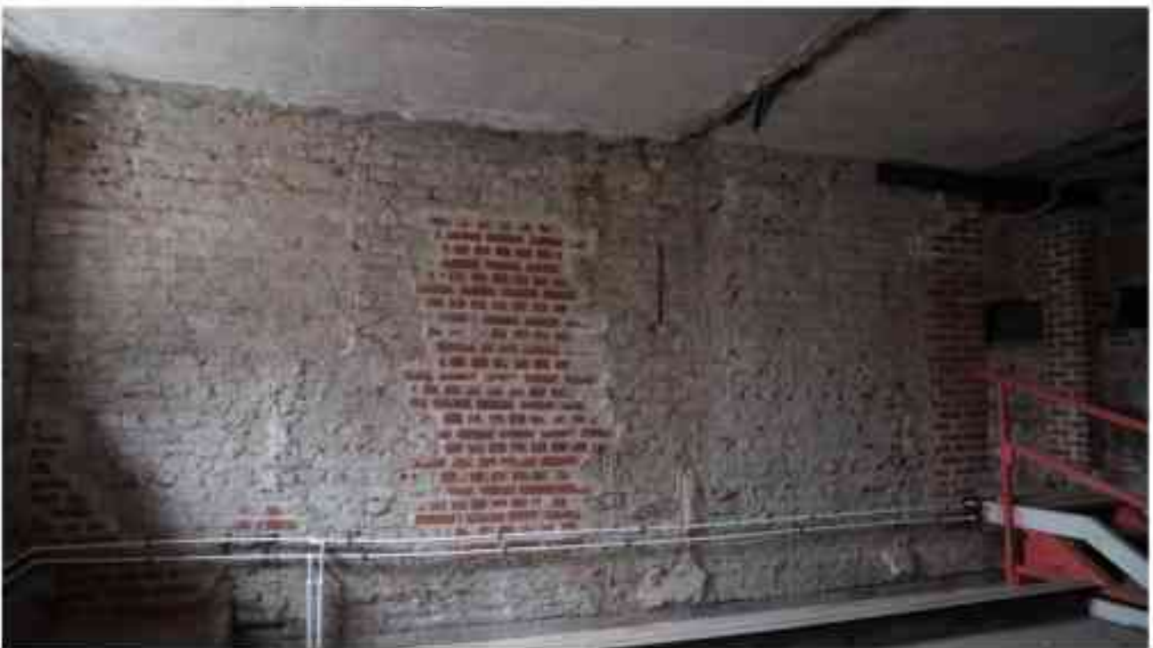
Фото 5.58. 5 этаж, помещение 35Н (8-11).
