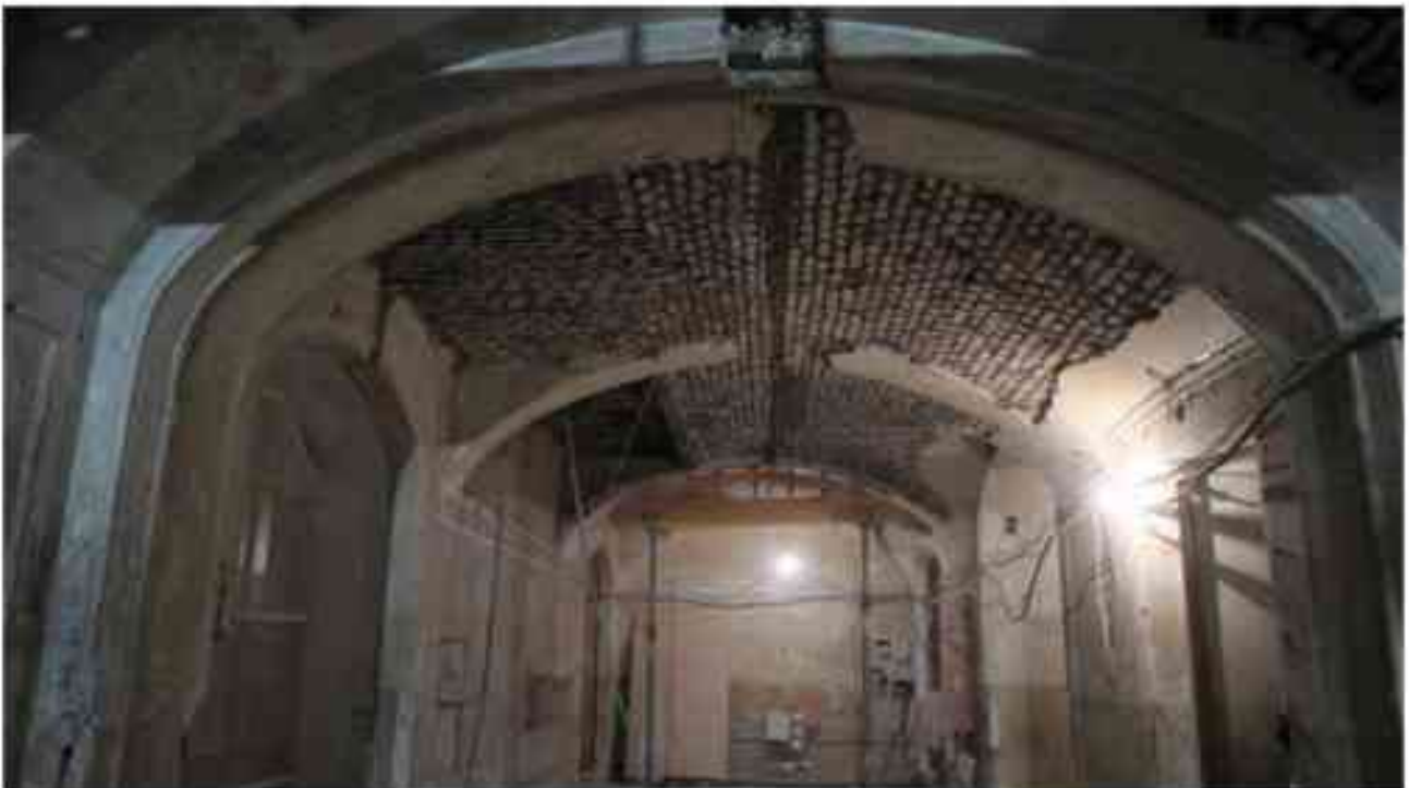
Фото 3.55. 3 этаж, помещение 28Н (11, 13).
