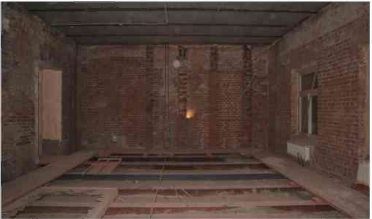
Фото 4.70. 4 этаж, помещение 33Н (51).
