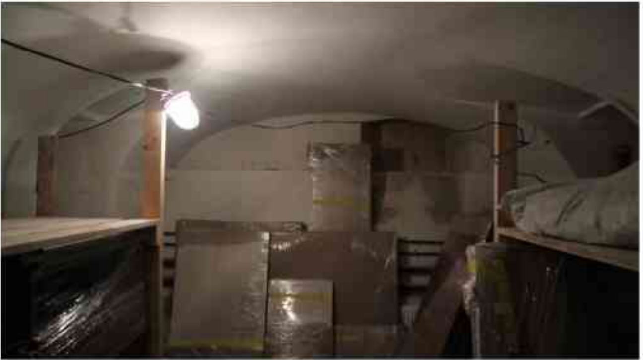
Фото п.133. Подвал, помещение 9Н (20).
