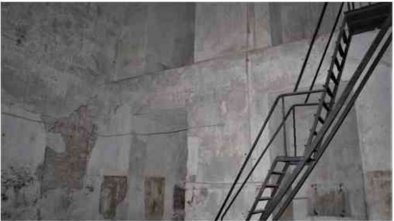
Фото 2.92. 2 этаж, помещение 22Н (80).
