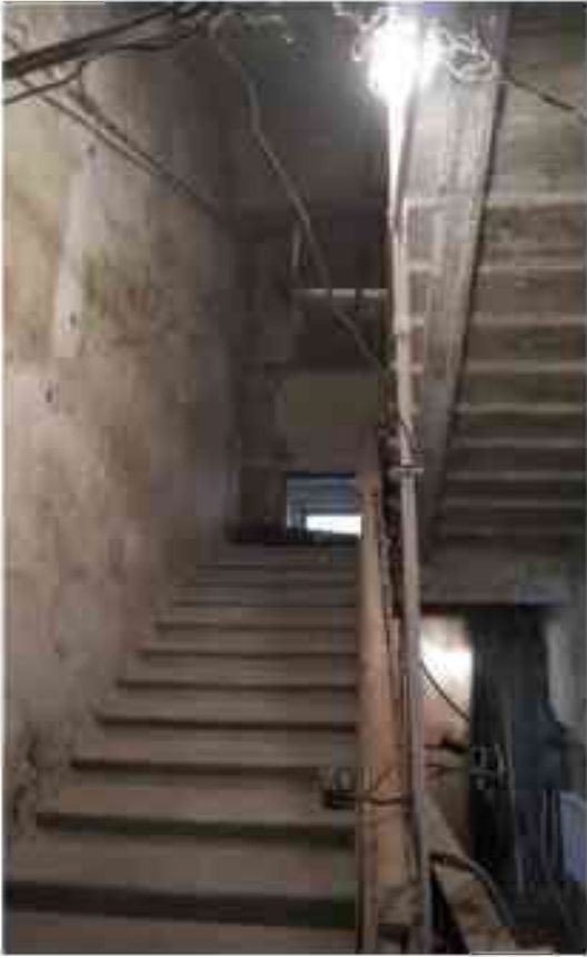
Фото 1.179. 1 этаж, лестница Л-6.
