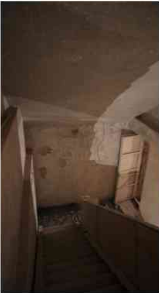
Фото 5.198. 5 этаж, лестница Л-20.
