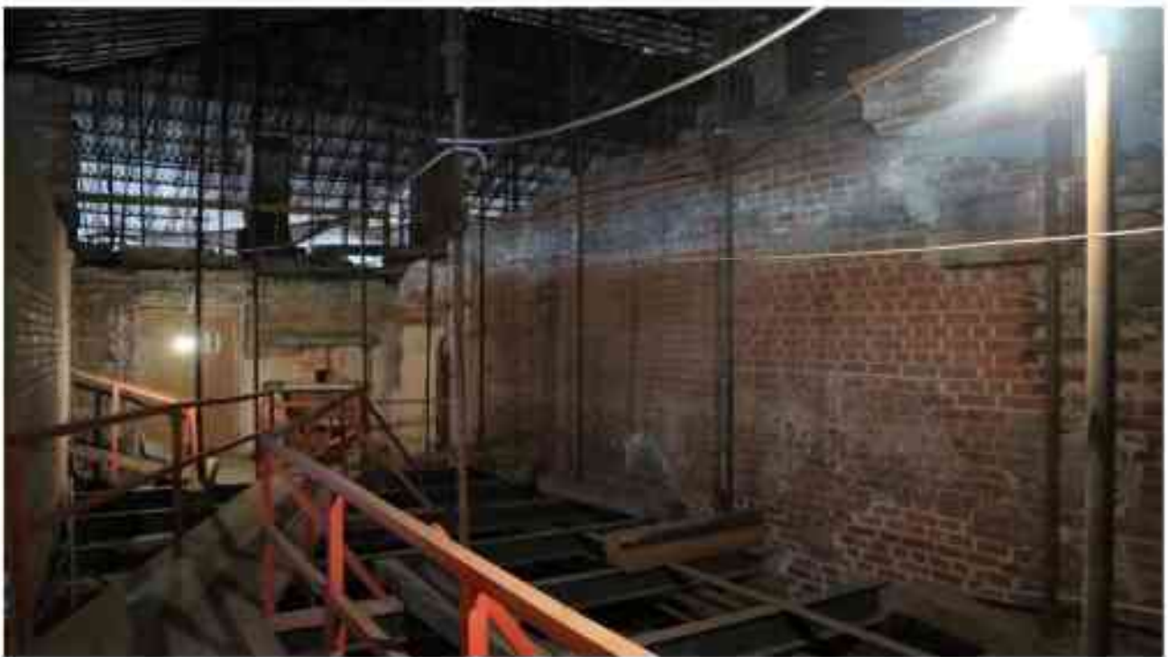
Фото 5.179. 5 этаж, коридор, помещения 34Н/37Н.
