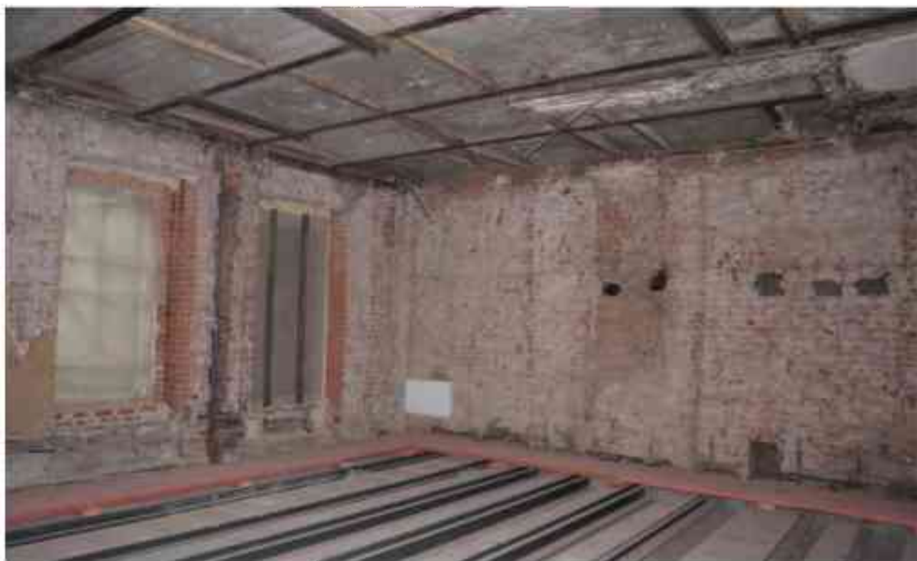
Фото 3.67. 3 этаж, помещение 28Н (5-10).
