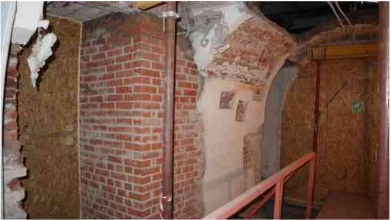
Фото 5.4. 5 этаж, помещение 37Н (1).
