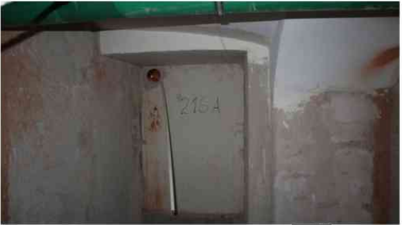
Фото п.84. Подвал, помещение 9Н (21).
