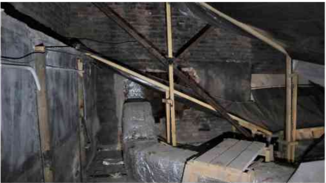
Фото 5.117. Чердак уровня 5 этажа.
