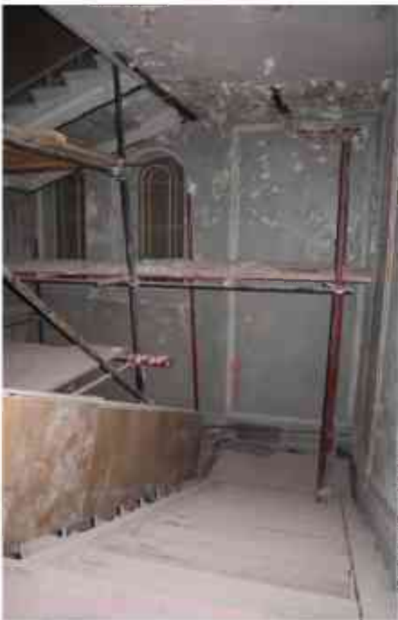
Фото 4.131. 4 этаж, лестница в ризалите южного фасада (западная часть).*
