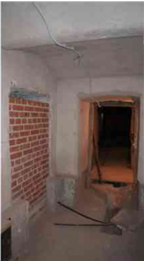
Фото п.207. Подвал, помещение 9Н (5).
