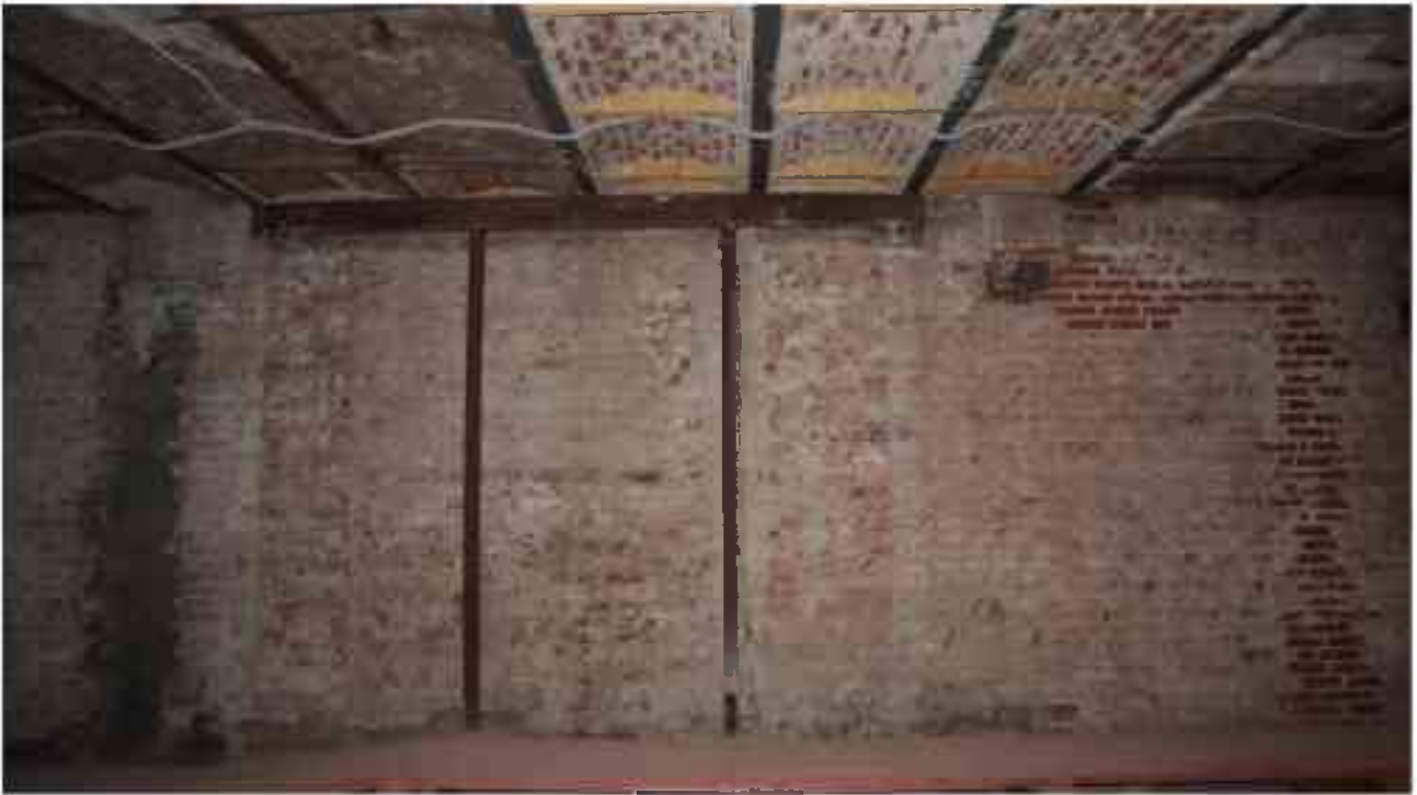
Фото 4.192. 4 этаж, помещение 42Н* (3-4, 8-9).
