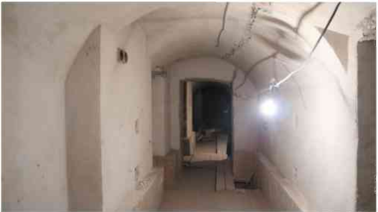
Фото п.200. Подвал, помещение 9Н (25).
