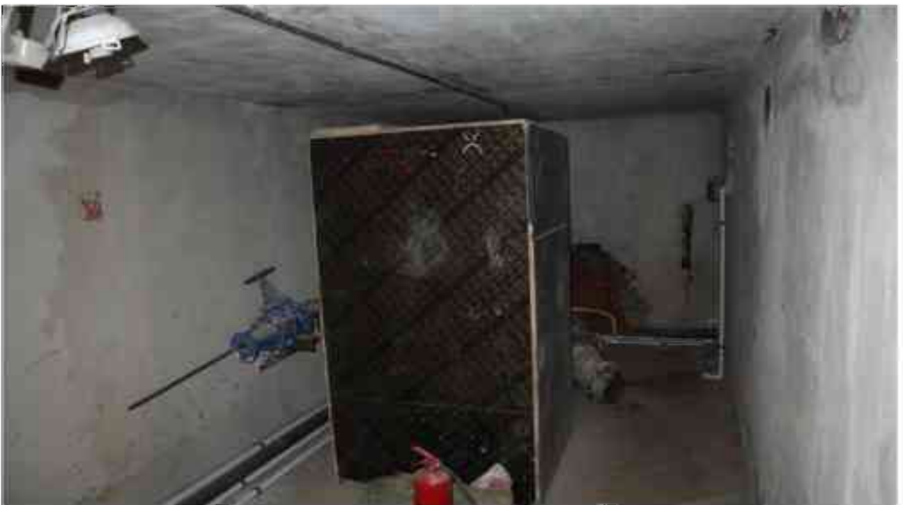
Фото п.14. Подвал, помещение 2Н (4).
