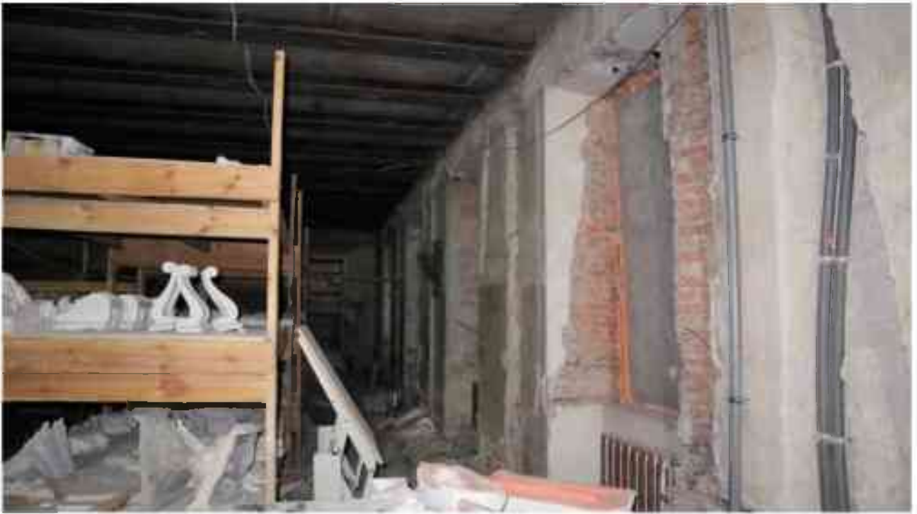
Фото 2.100. 2 этаж, помещение 22Н (33-35, 38-40).
