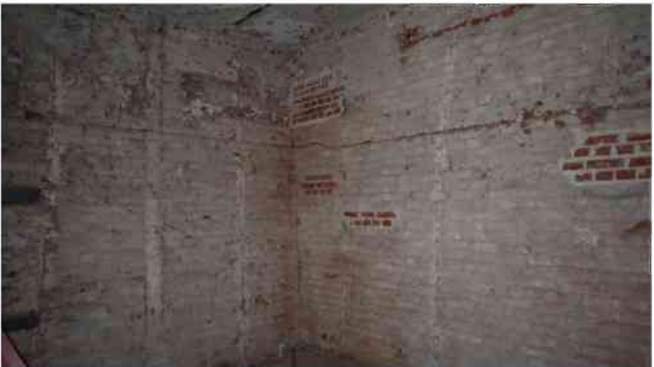
Фото 1.228. 1 этаж, помещение 15Н (4).
