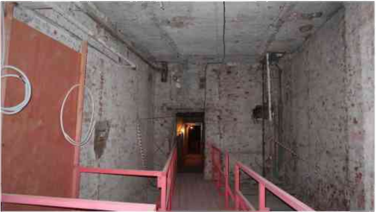
Фото 4.117. 4 этаж, коридор, помещение 29Н (3-4).
