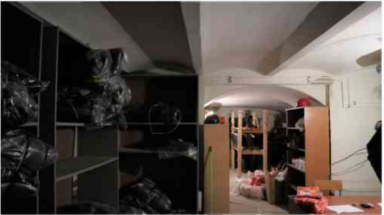
Фото п.118. Подвал, помещение 4Н (8-9).
