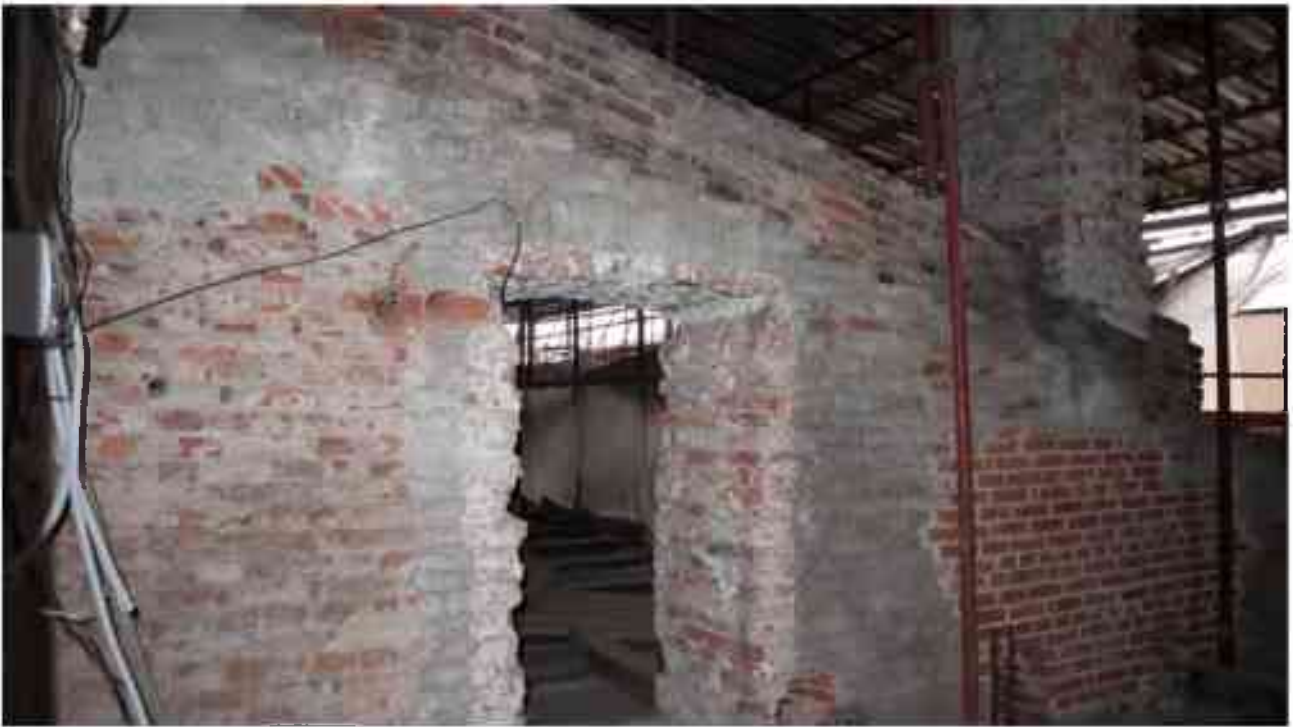
Фото 5.190. 5 этаж, чердачное помещение.
