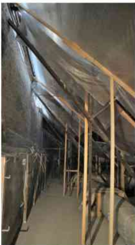
Фото 5.115. Чердак уровня 5 этажа.
