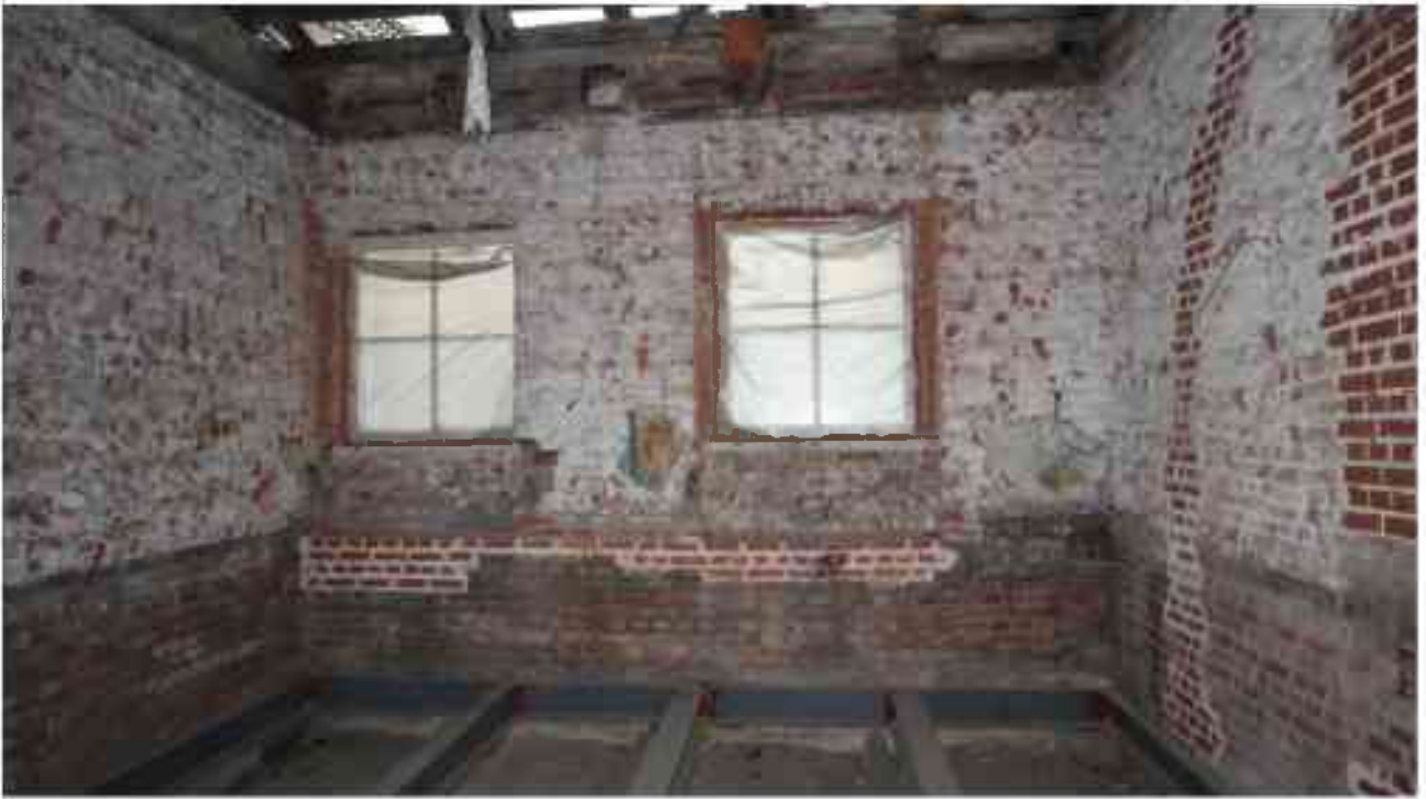
Фото 5.146. 5 этаж, жилой блок, на плане ПИБ 2000г. обозначен как квартиры, помещение (4-6).
