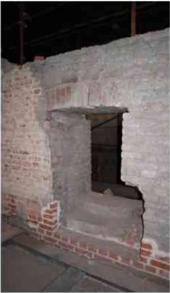
Фото 5.160. 5 этаж, чердачное помещение.
