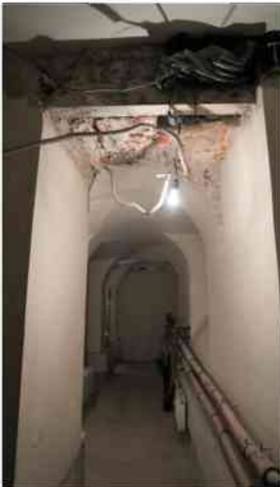
Фото п.136. Подвал, помещение 9Н (18).
