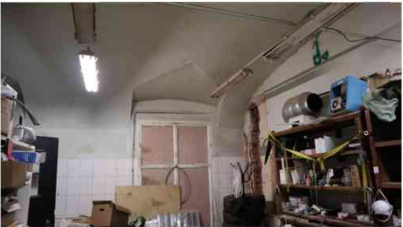
Фото 1.47. 1 этаж, помещение 14Н (7).
