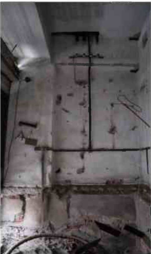
Фото 1.331. 1 этаж, помещение 16Н (1).
