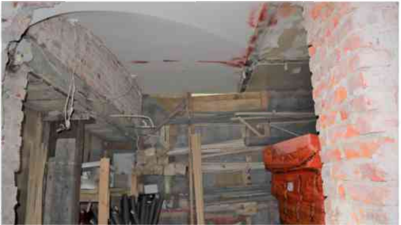
Фото 1.39. 1 этаж, помещение 14Н (12).
