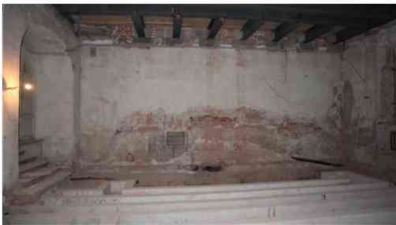
Фото 1.175. 1 этаж, помещение 31Н (18-19).
