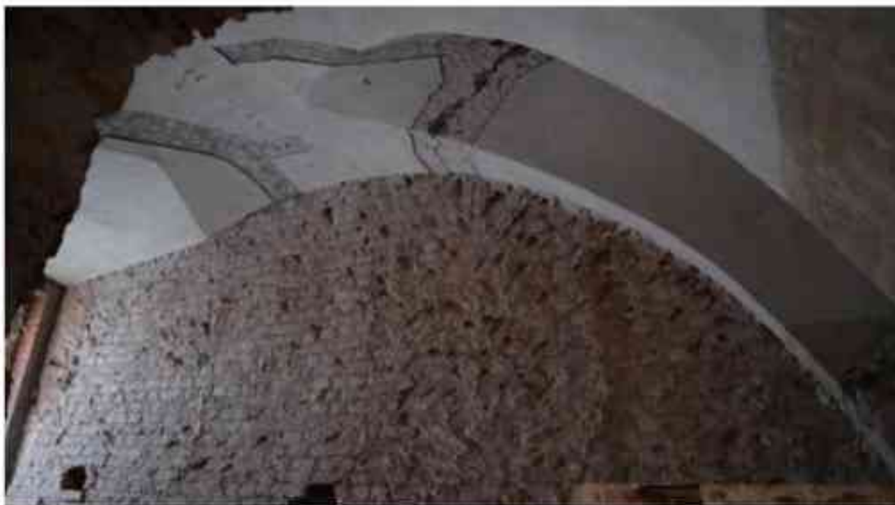
Фото 3.102. 3 этаж, помещение 28Н (6).
