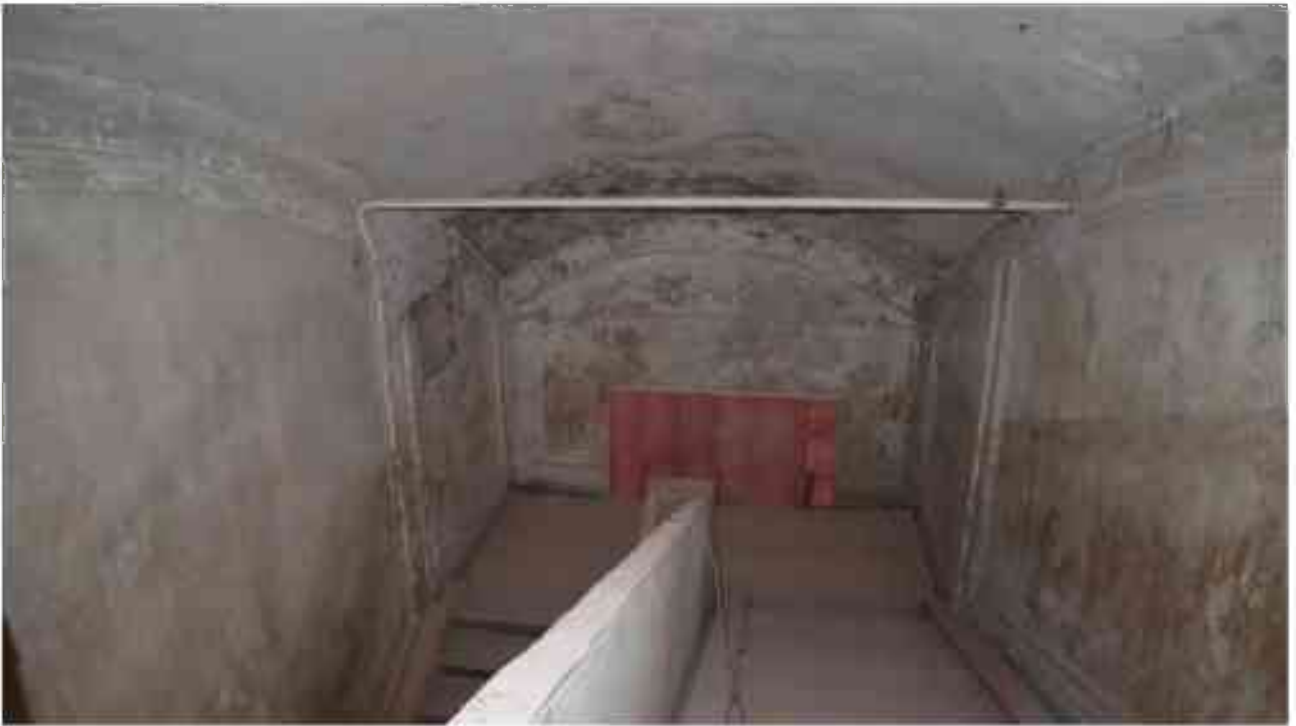
Фото 5.196. 5 этаж, лестница Л-21.
