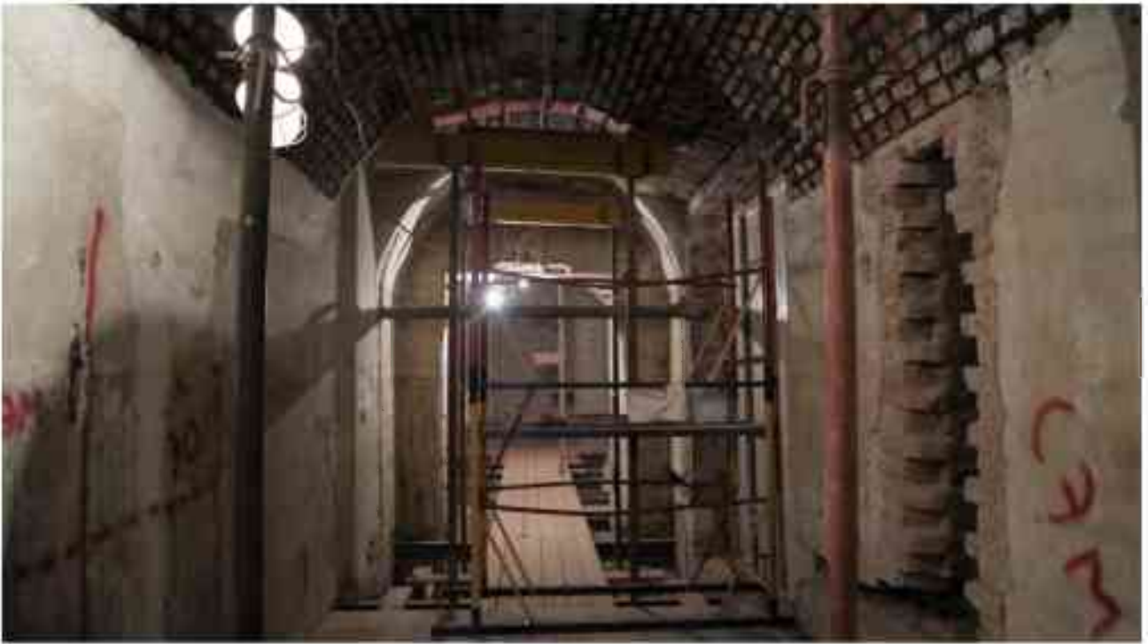
Фото 4.103. 4 этаж, коридор, помещение 33Н (13-15).
