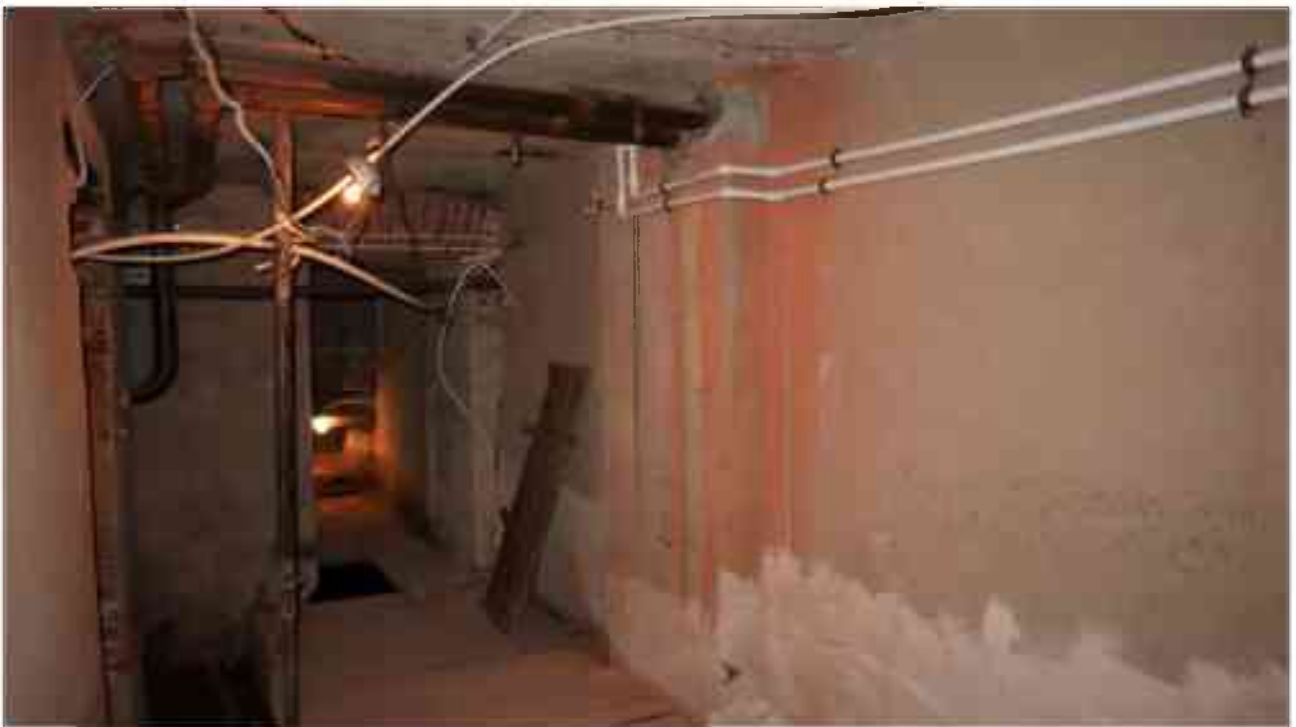
Фото п.62. Подвал, помещение 3Н (1).
