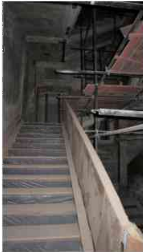
Фото 1.344, 1.345. 1 этаж, лестница с перекрестными маршами, трехмаршевая, в центре здания.*
