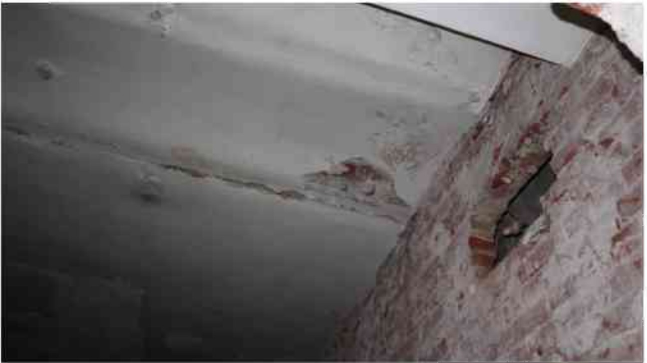
Фото 4.31. 4 этаж, помещение 33Н (33).
