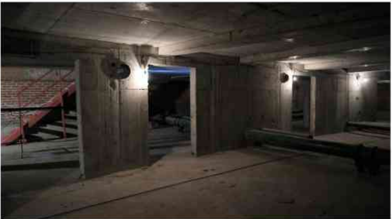
Фото п.35. Подвал, помещение 3Н (12).
