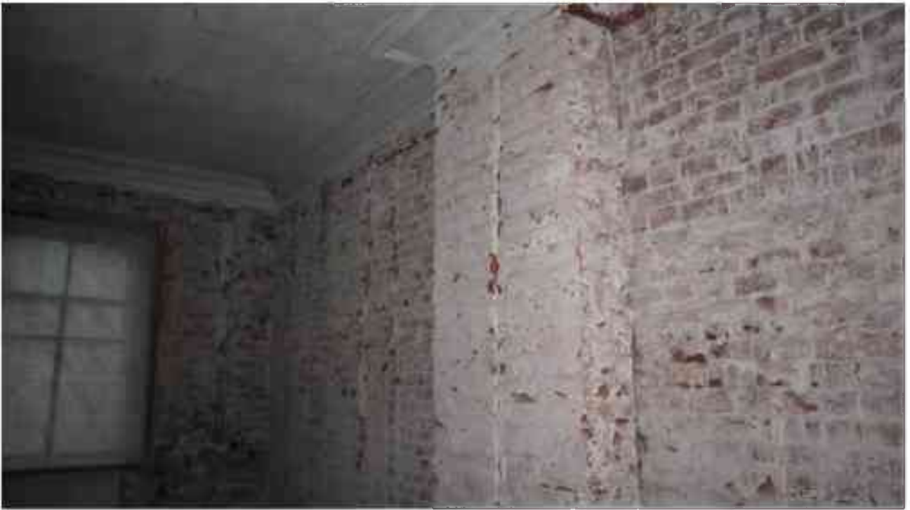
Фото 4.55. 4 этаж, помещение 33Н (29).
