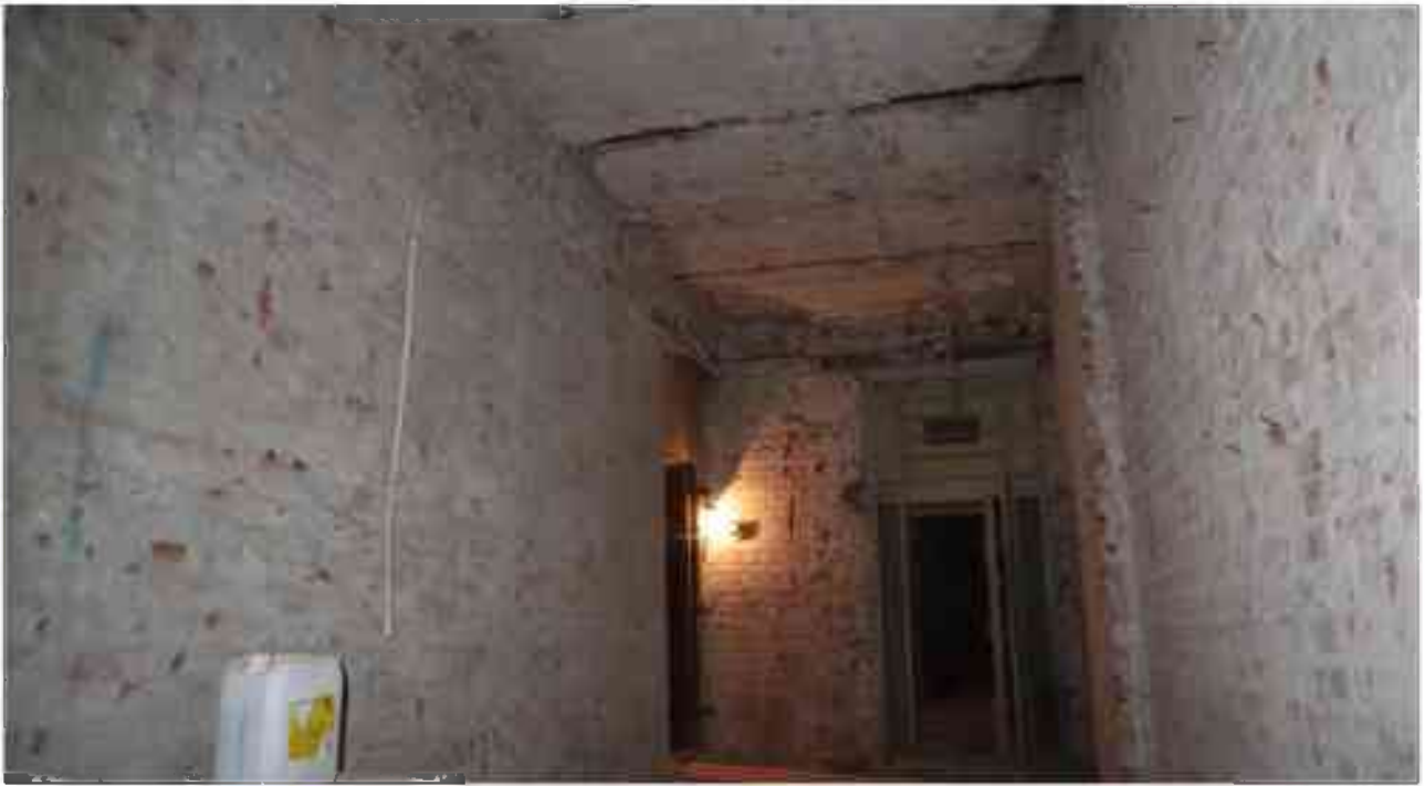
Фото 4.185. 4 этаж, помещение 42Н* (1, 3).
