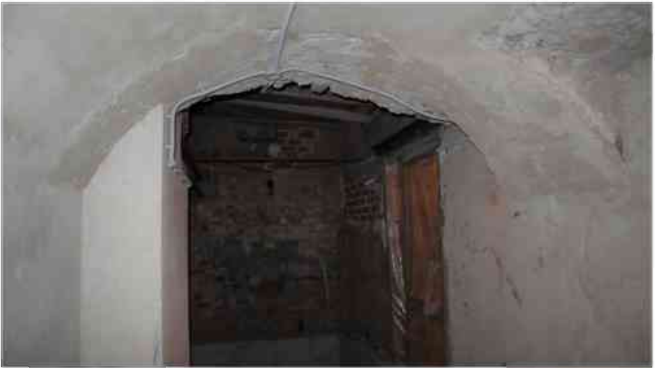
Фото п.220. Подвал, помещение 9Н (3).
