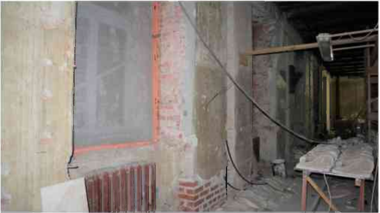
Фото 2.102. 2 этаж, помещение 22Н (33-35, 38-40).
