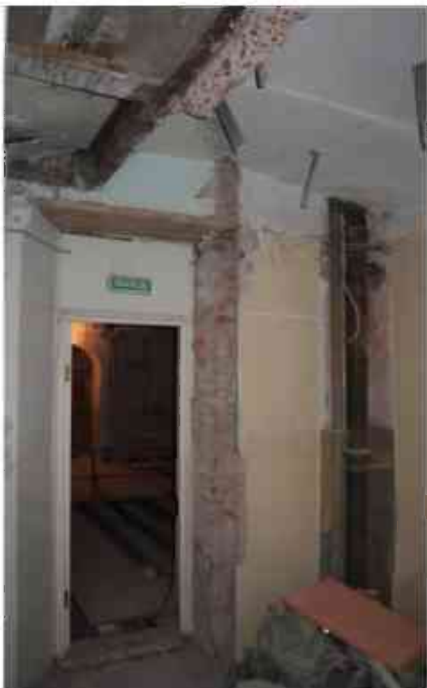
Фото 3.71. 3 этаж, помещение 28Н (1, 3-4).
