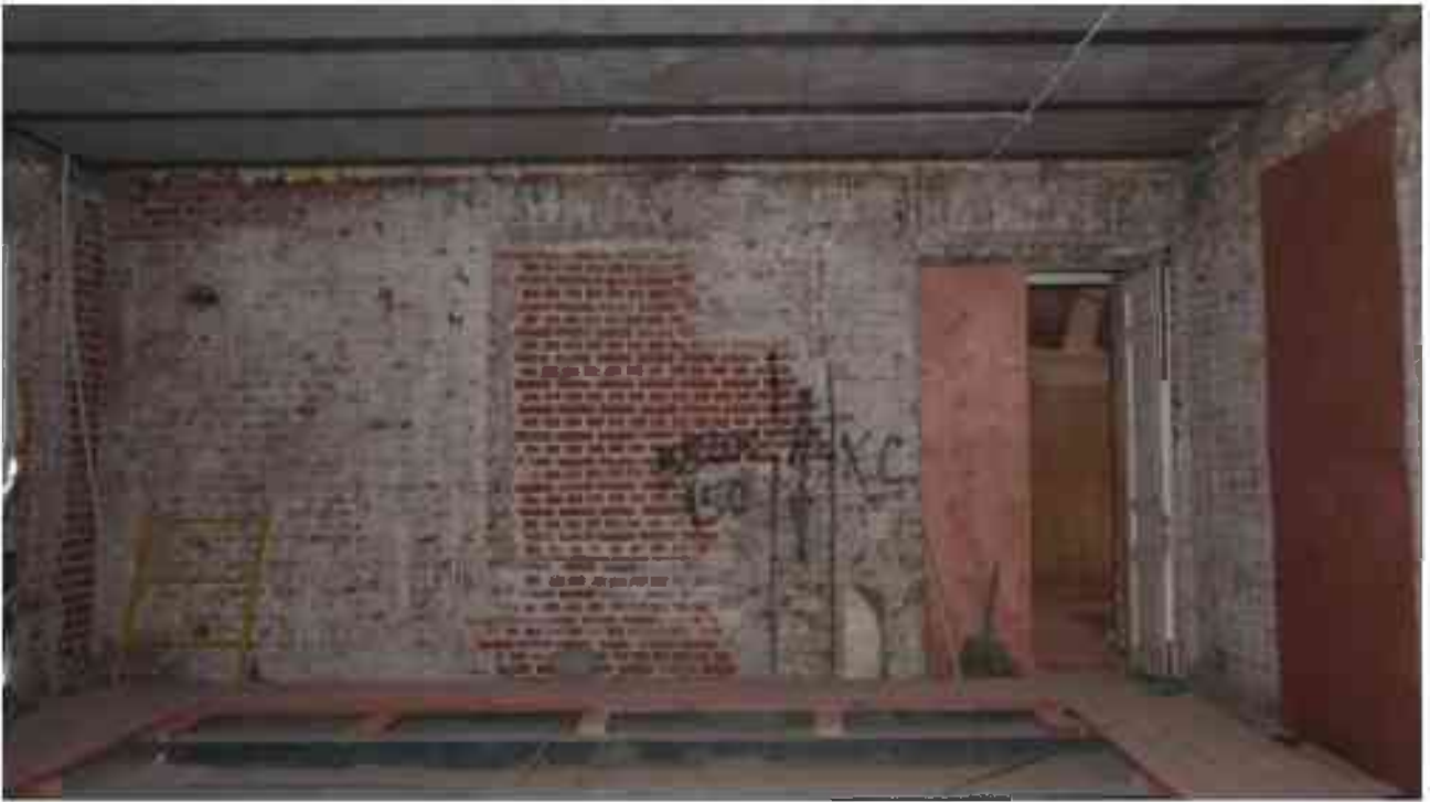
Фото 4.77. 4 этаж, помещение 33Н (16-20).
