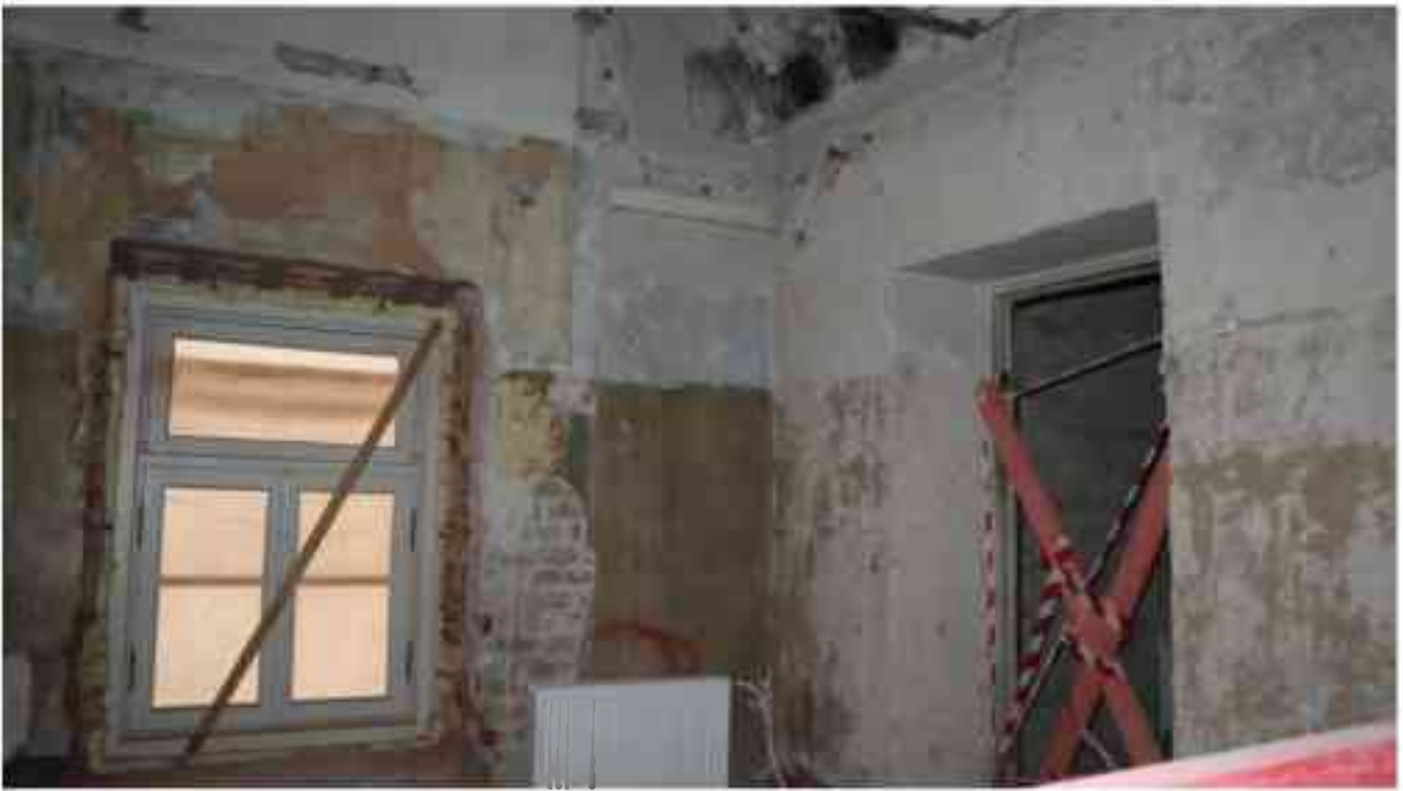
Фото 3.155. 3 этаж, помещение 23Н (8-9).
