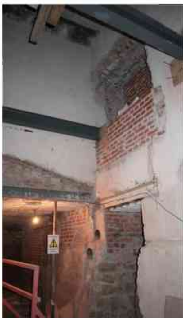
Фото п.333. Подвал, помещение 1Н (4-8).
