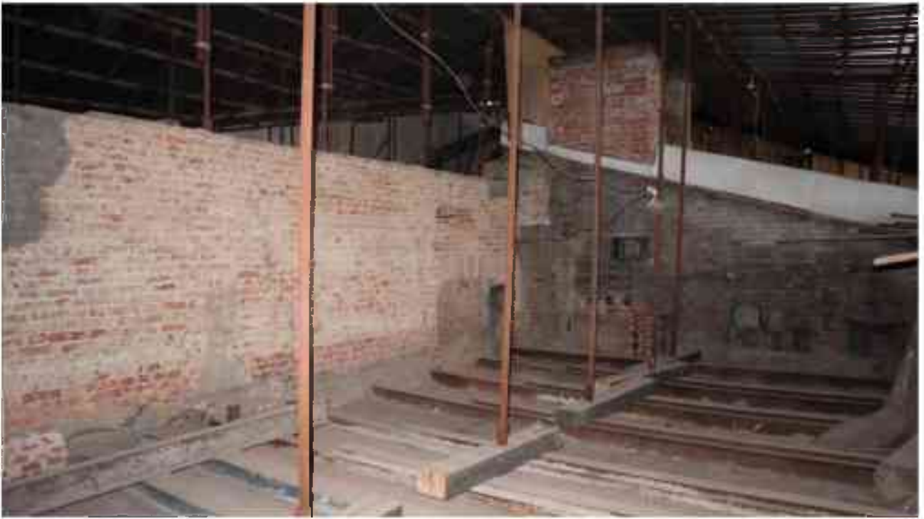
Фото 5.158. 5 этаж, чердачное помещение.
