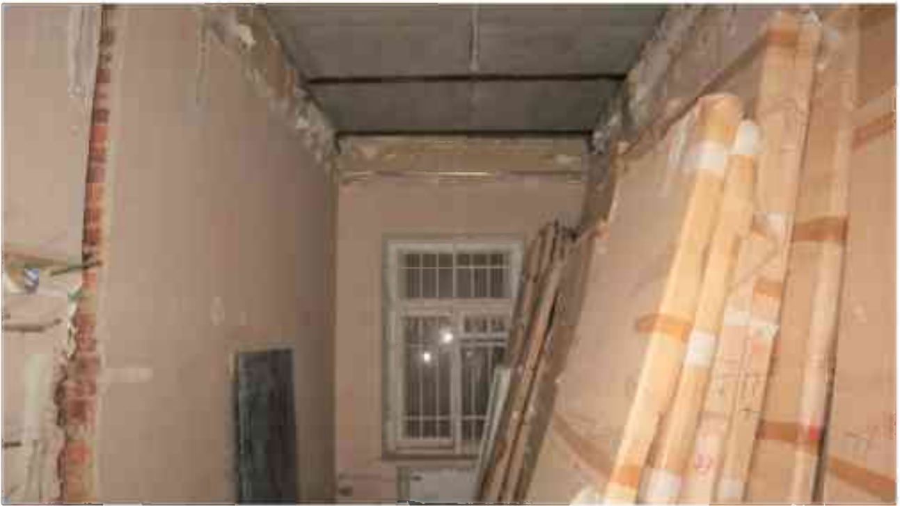
Фото 1.58. 1 этаж, помещение 14Н (19).
