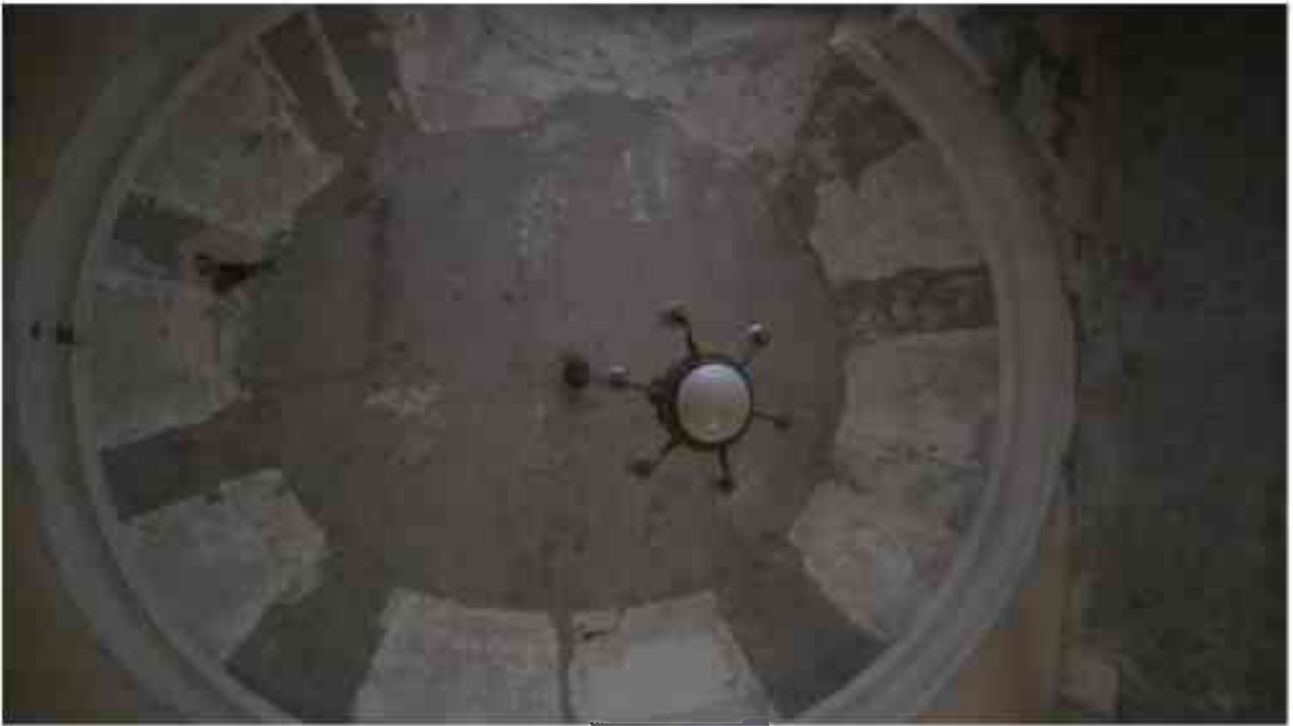
Фото 2.187. 2 этаж, помещение 22Н (25).
