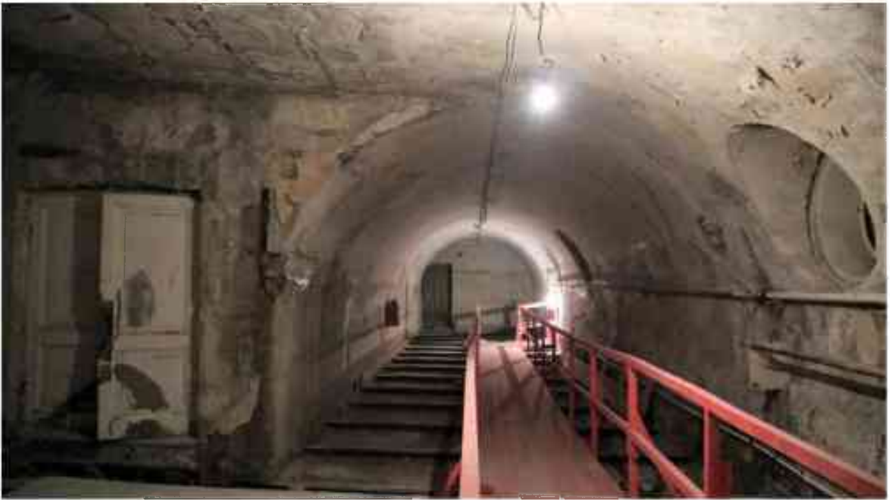
Фото 5.102. 5 этаж, помещение 35Н(2, 4).
