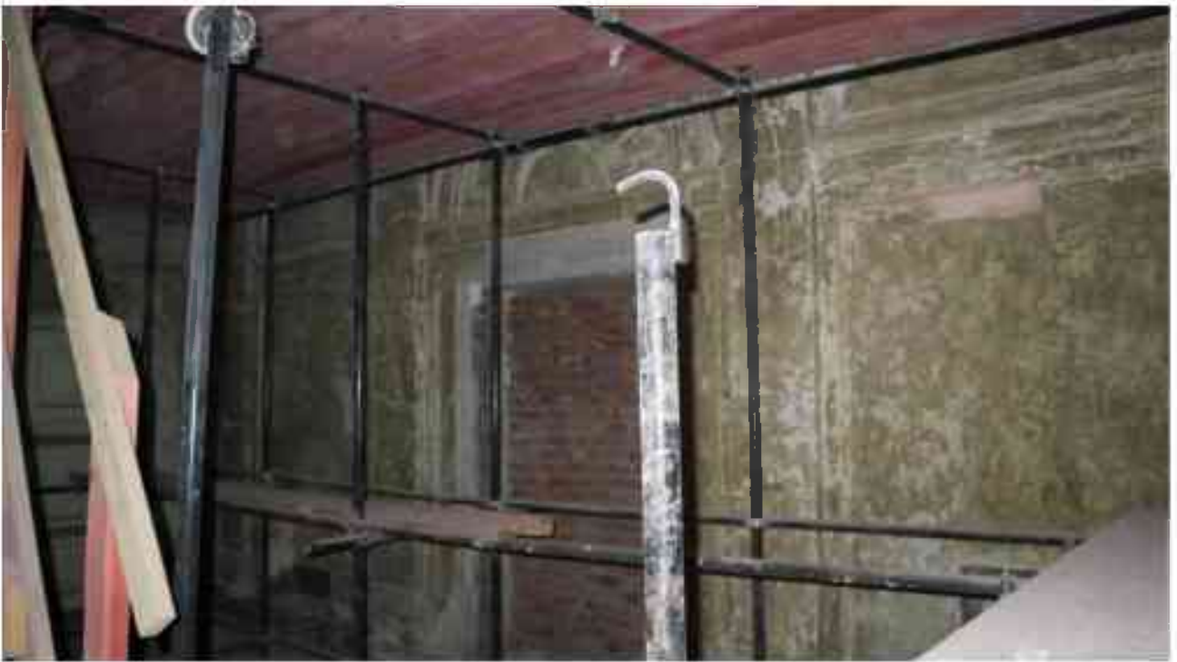
Фото 3.146. 3 этаж, помещение 25Н (11).
