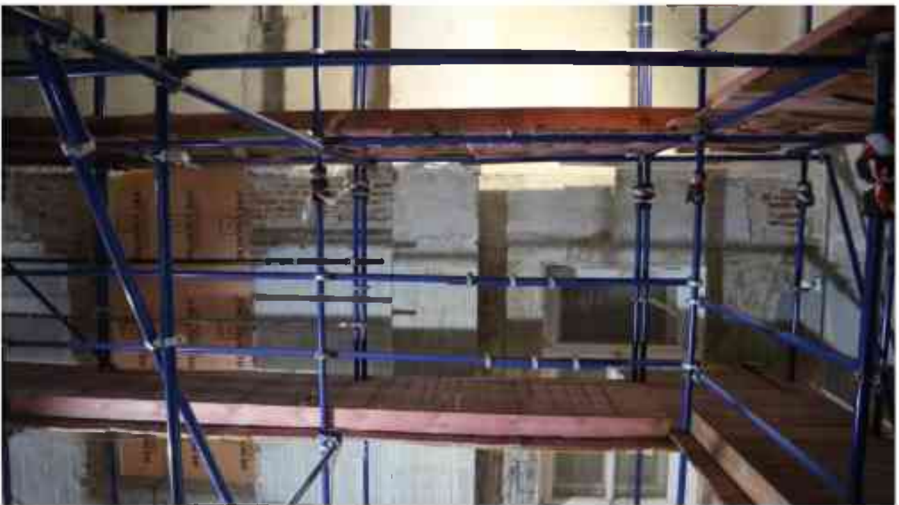
Фото 3.49. 3 этаж, помещение 28Н (20-21).*
