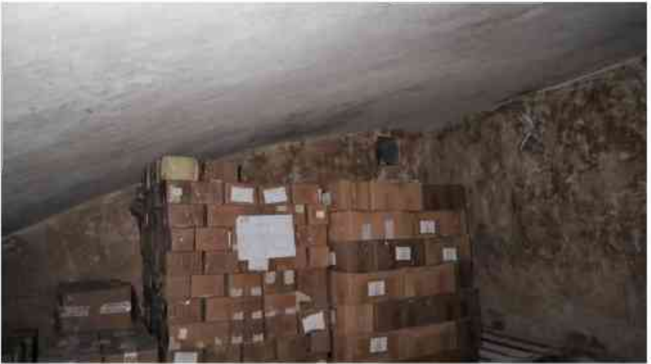
Фото 1.264. 1 этаж, помещение 13Н (26).
