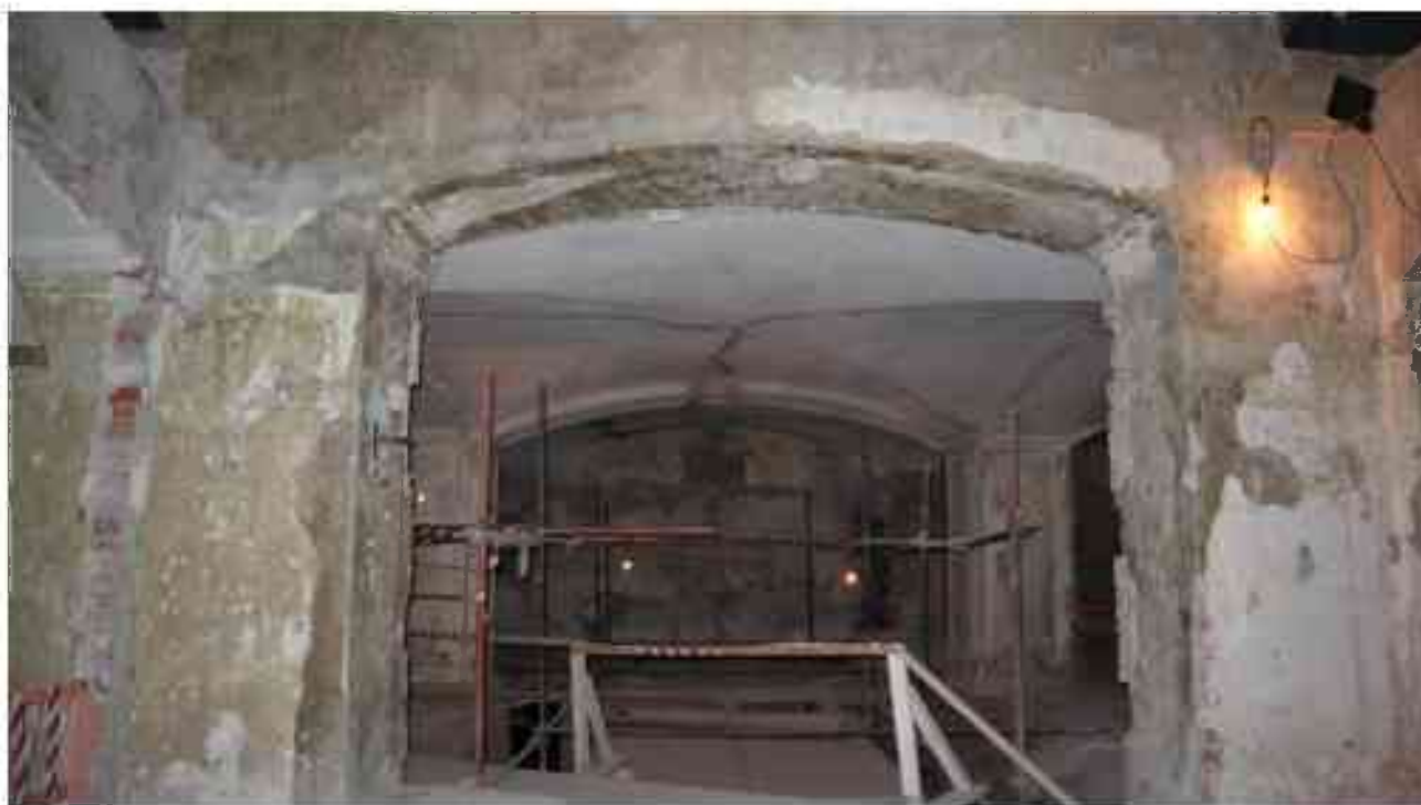
Фото 1.298. 1 этаж, помещение 13Н (35).
