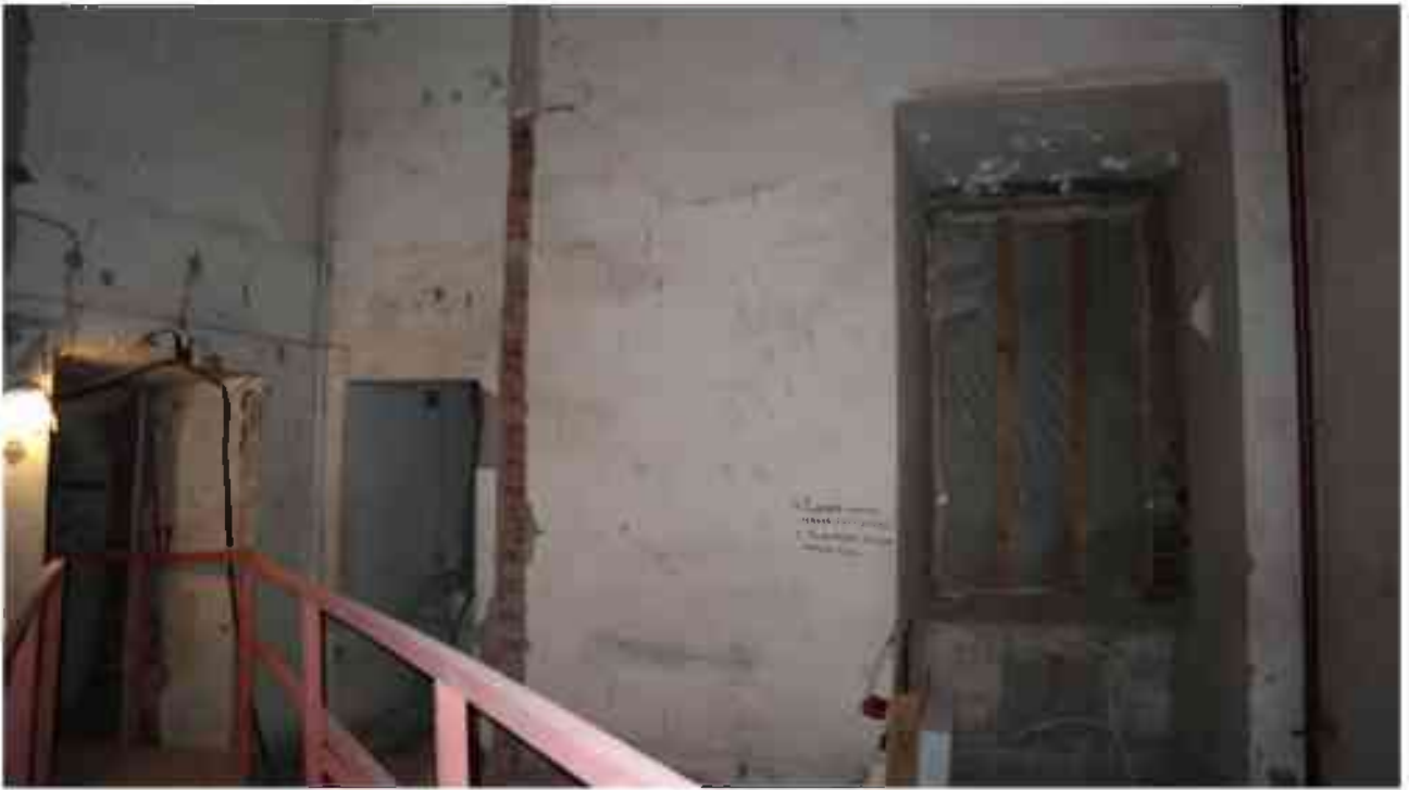
Фото 2.88. 2 этаж, помещение 22Н (76-78, 82, 84).
