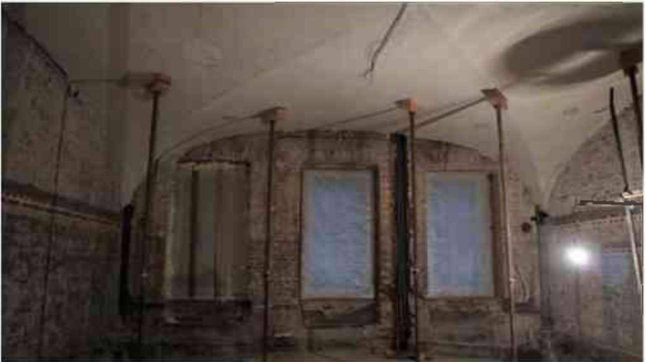
Фото 2.58. 2 этаж, помещение 22Н (37, 87-89).
