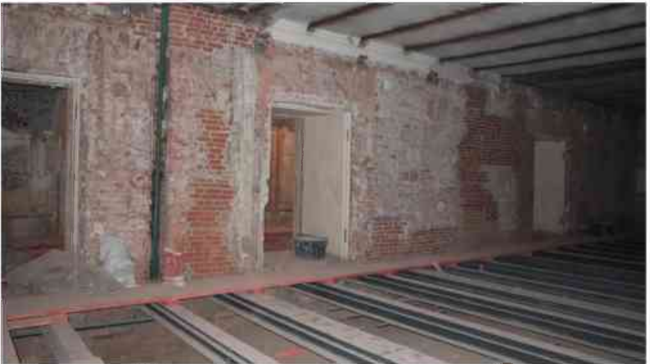
Фото 4.64. 4 этаж, помещение 33Н (47-49).
