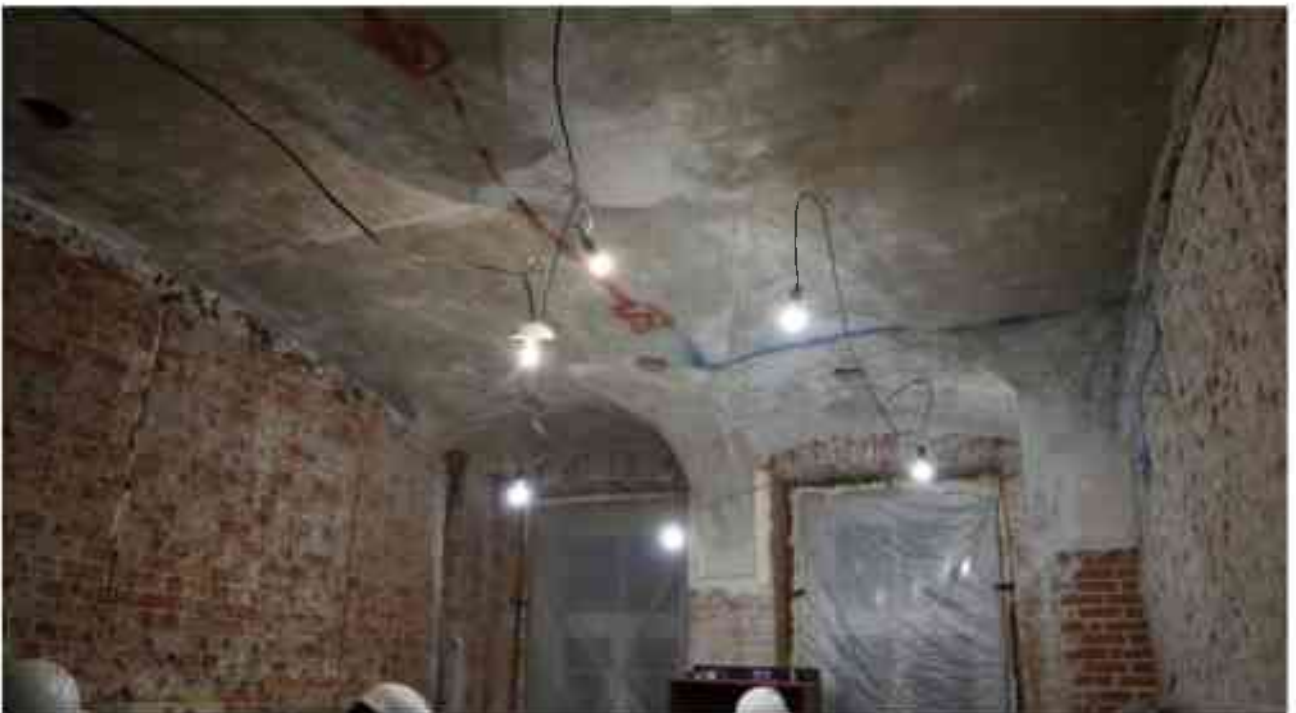
Фото 2.46. 2 этаж, помещение 22Н (63).
