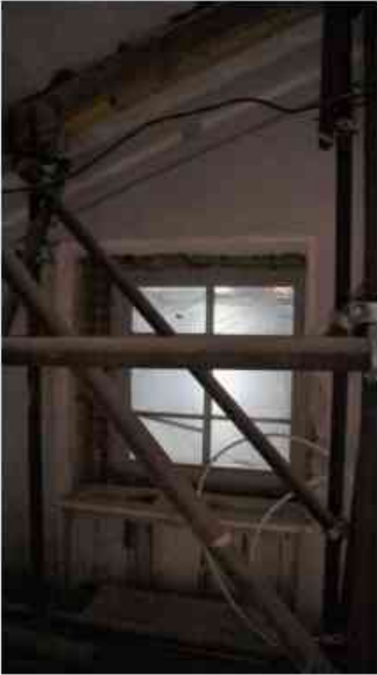
Фото 1.108. 1 этаж, лестница Л-16.
