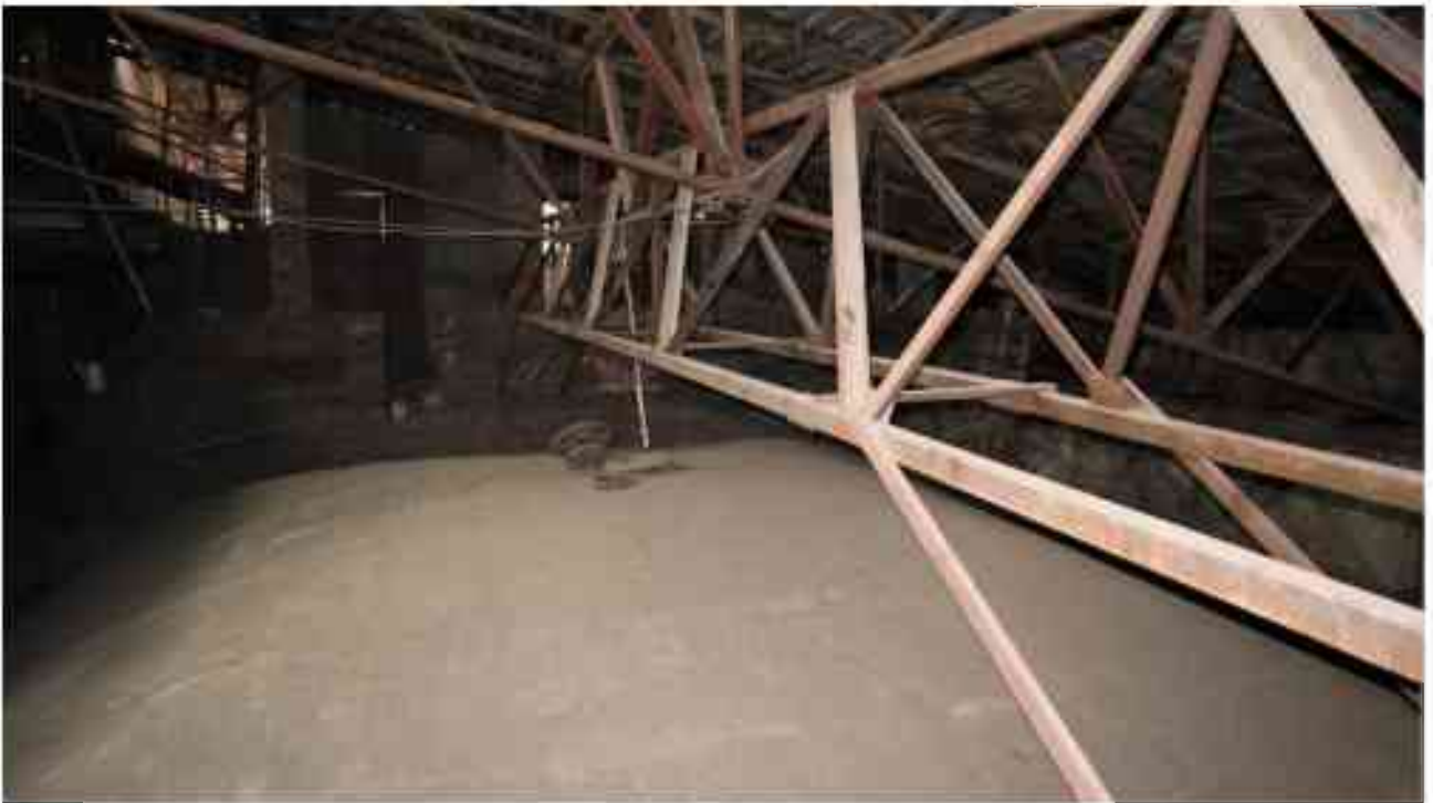
Фото 5.77. 5 этаж, чердачное помещение, купол.
