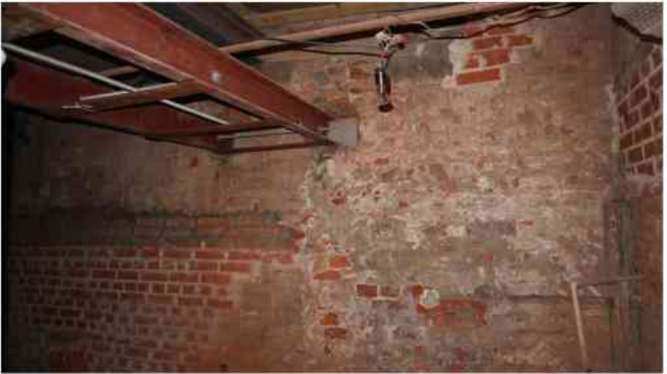
Фото п.227. Подвал, помещение 9Н (3).
