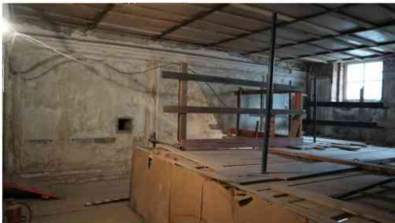
Фото 5.84. 5 этаж, лестница Л-13.
