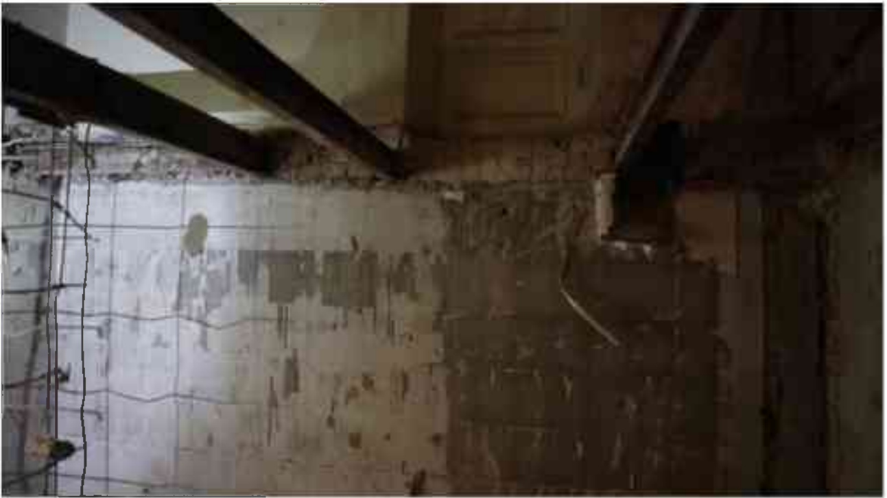
Фото 2.193. 2 этаж, помещение 22Н (8).
