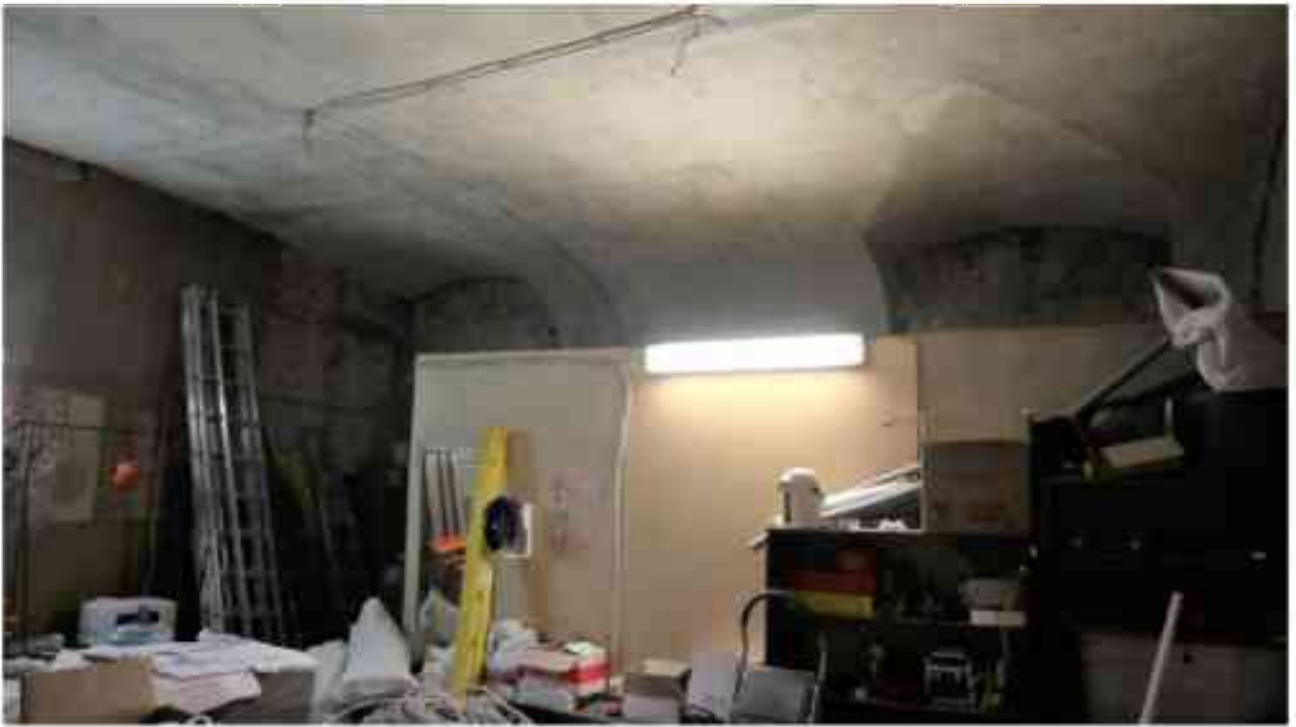
Фото 2.19. 2 этаж, помещение 22Н (47).
