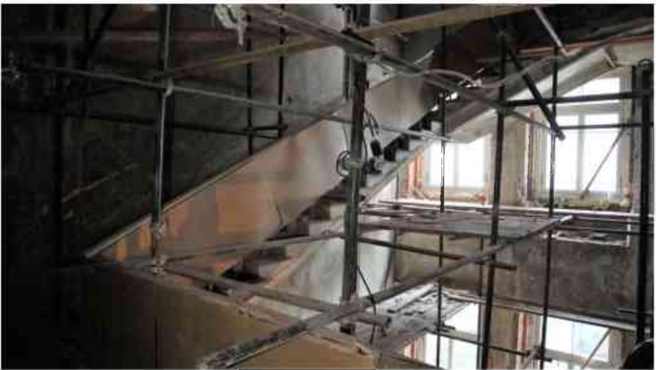
Фото 4.170. 4 этаж, лестница с перекрестными маршами, трехмаршевая, в центре здания.*
