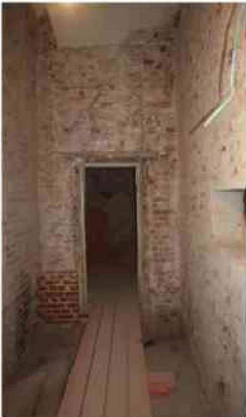
Фото 3.99. 3 этаж, помещение 28Н (4).
