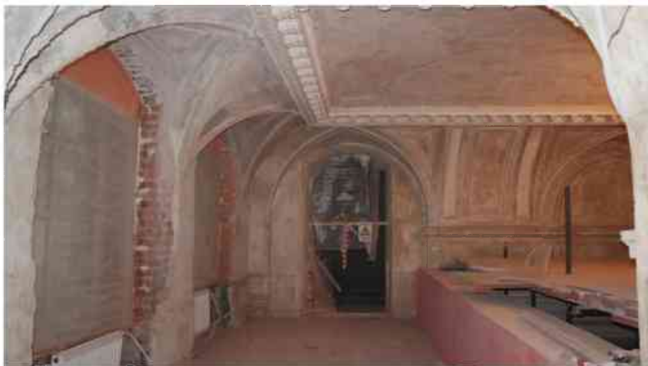
Фото 4.21. 4 этаж, помещение 33Н (32).
