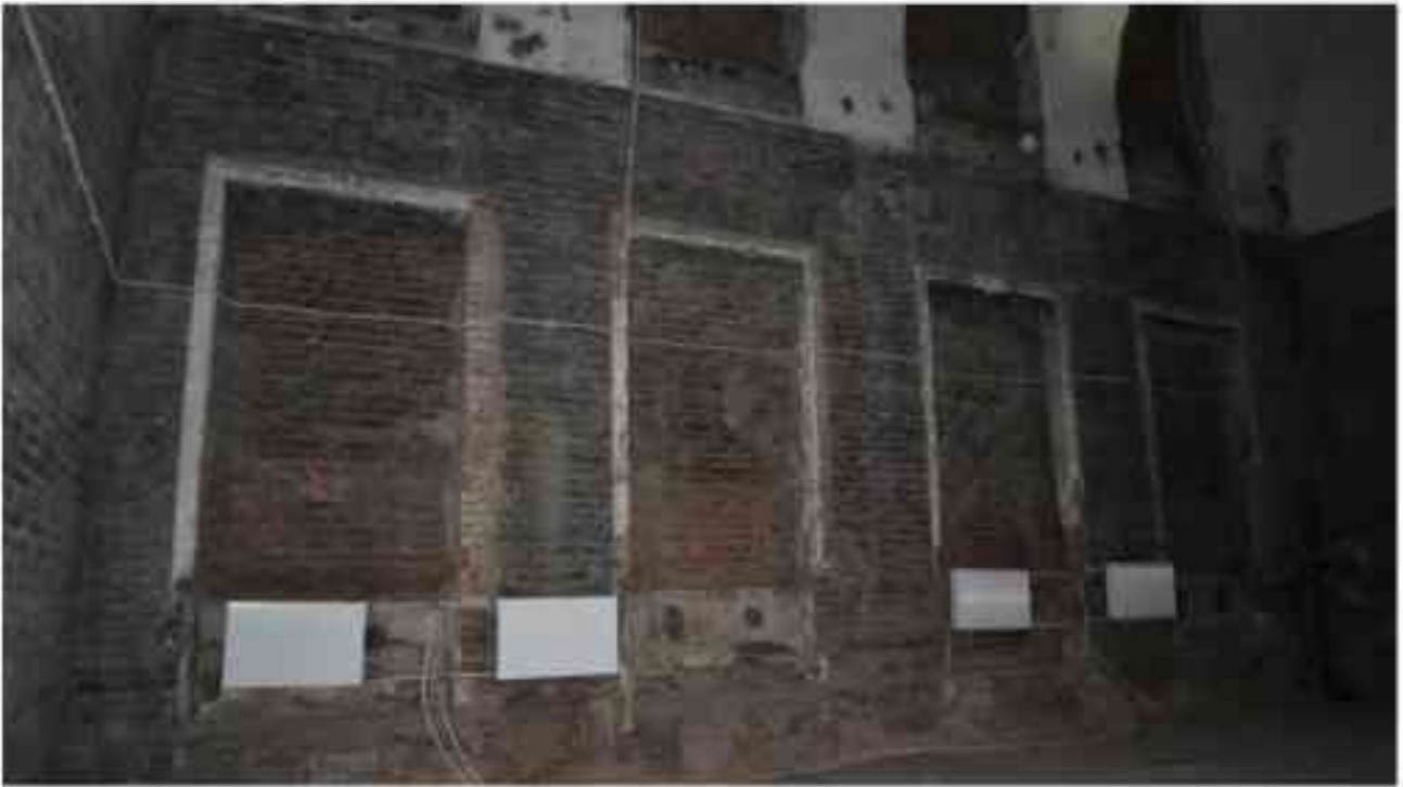
Фото 2.219. 2 этаж, помещение 22Н (83).
