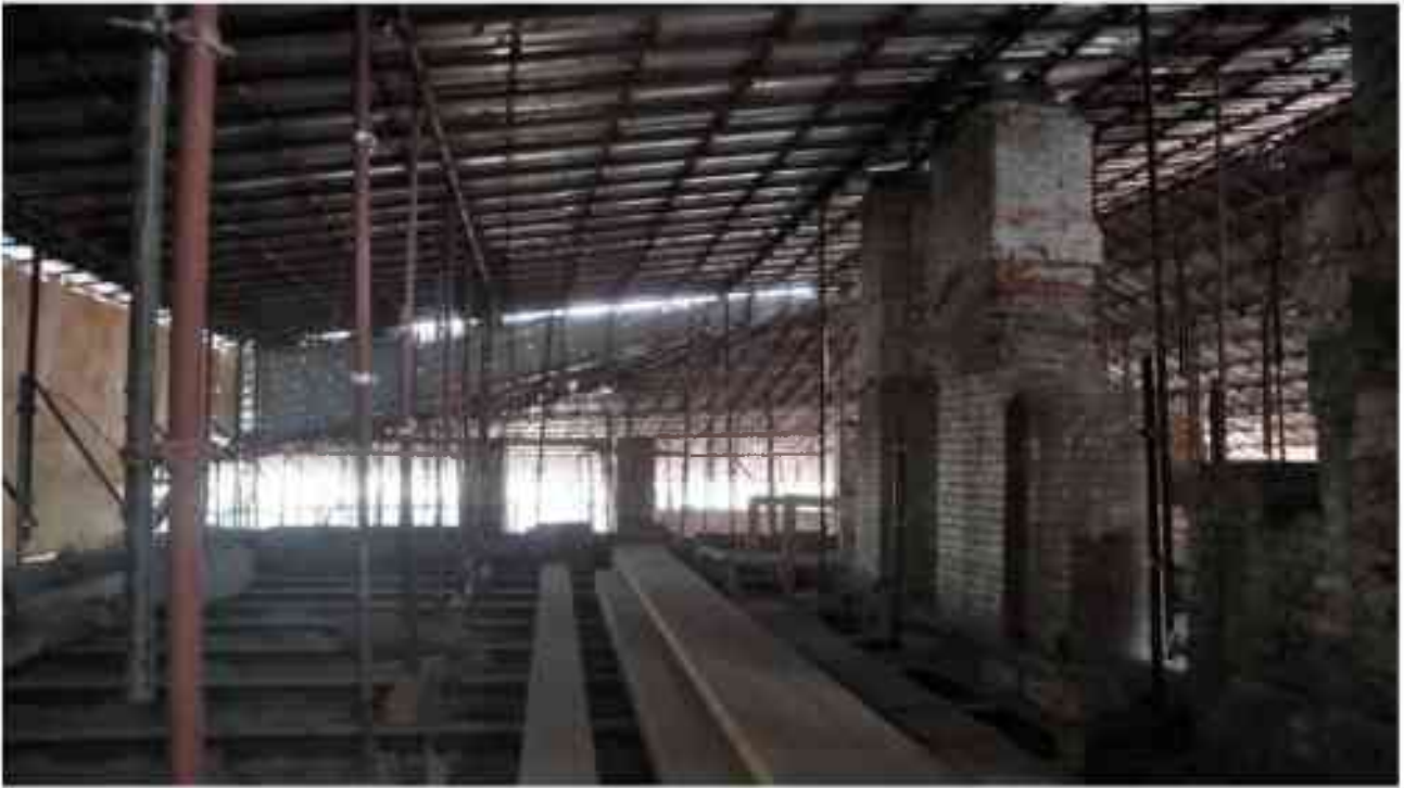
Фото 6.44. 6 этаж, чердачное помещение.
