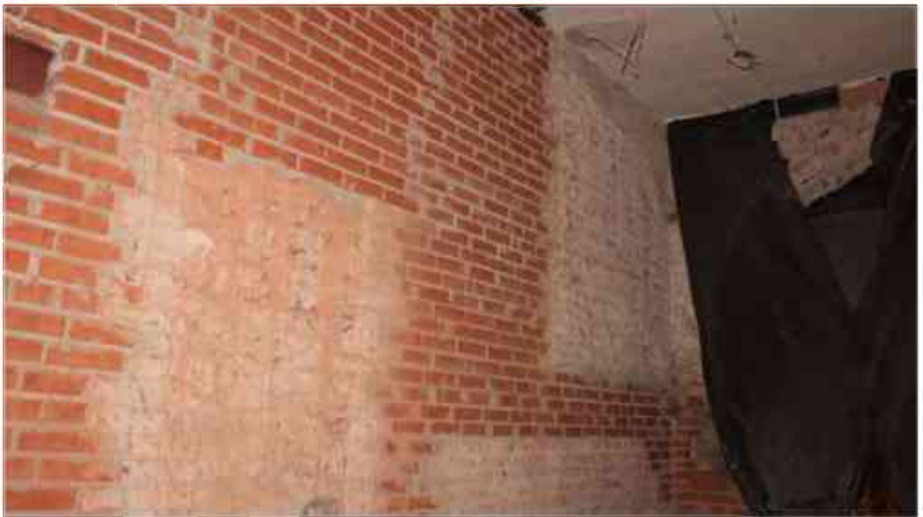
Фото 1.239. 1 этаж, помещение 17Н (7-8).
