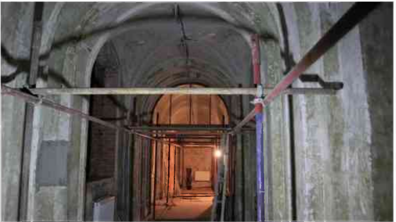
Фото 1.265. 1 этаж, помещение 13Н (16, 18).
