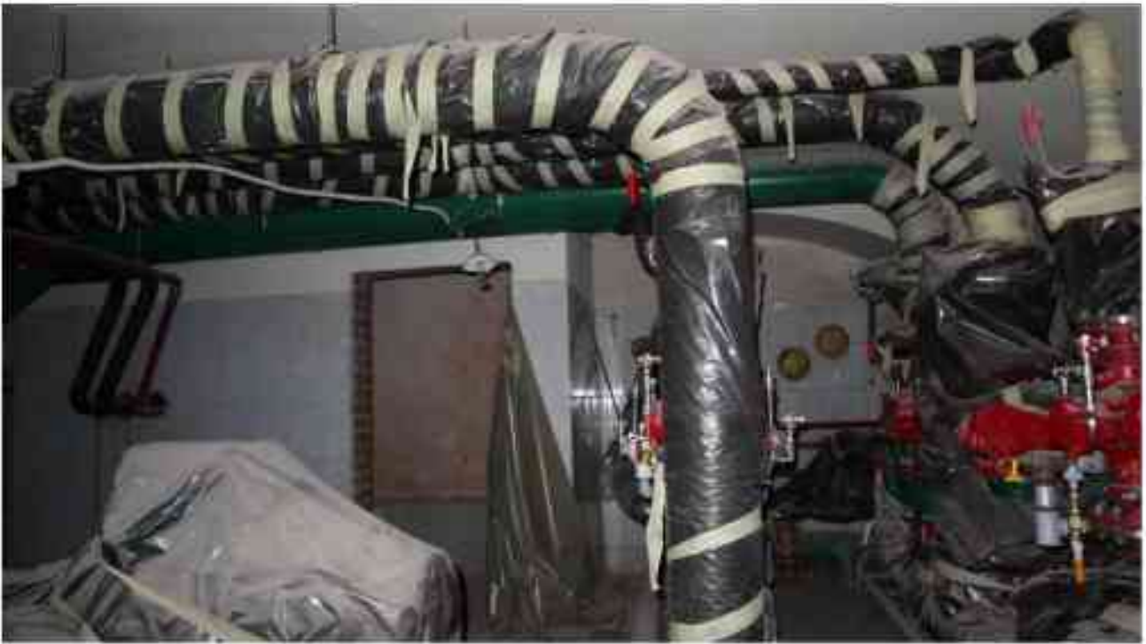
Фото п.170. Подвал, помещение 9Н (9).
