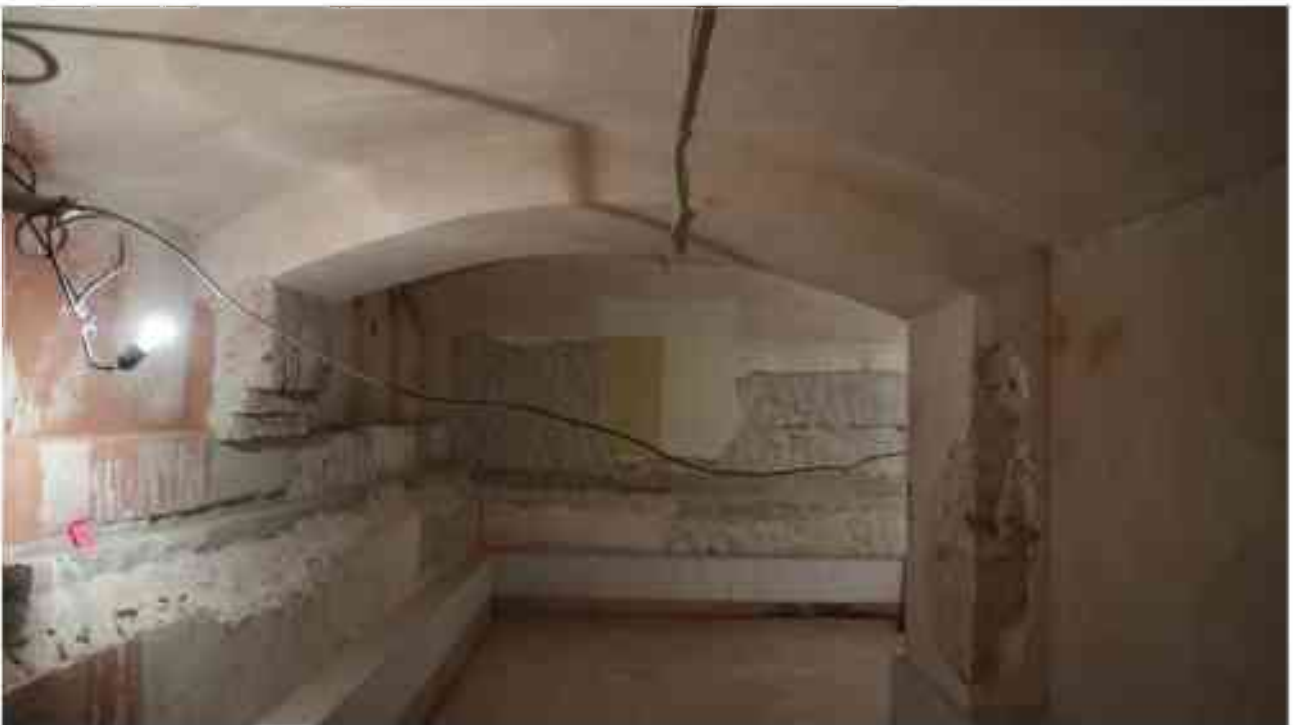
Фото п.273. Подвал, помещение 6Н (11-12).
