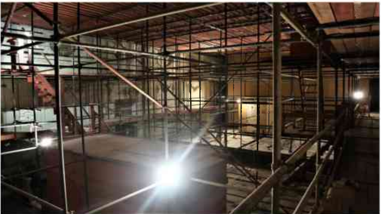
Фото 3.80. 3 этаж, помещение 28Н (2).*
