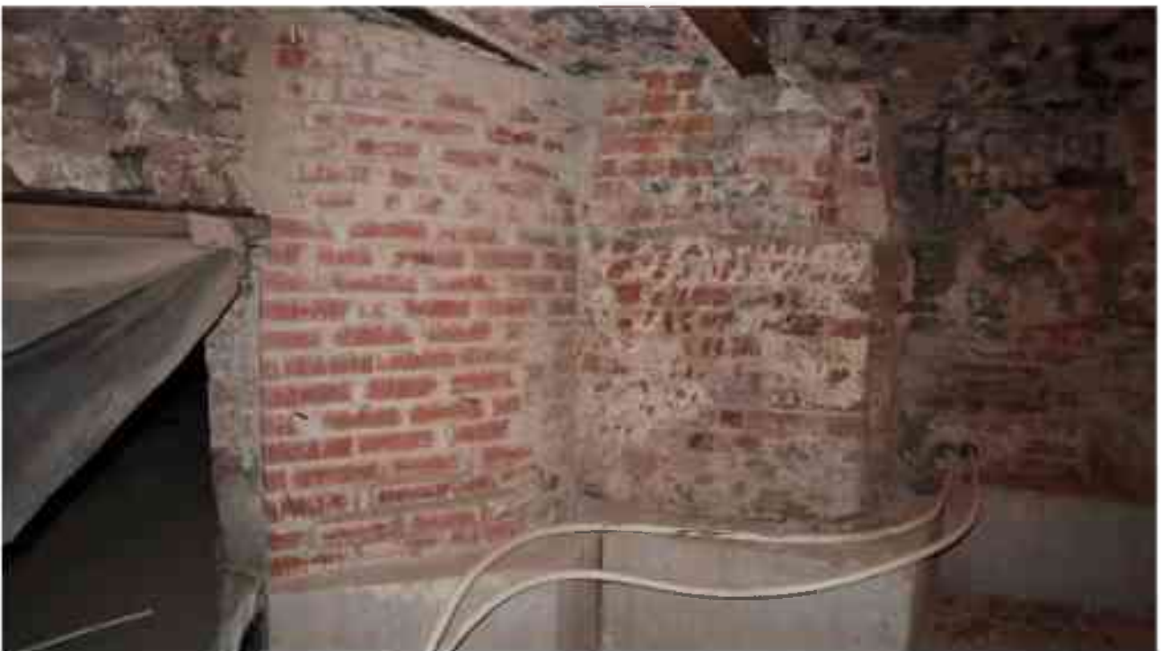
Фото п.293. Подвал, помещение 3Н (17).
