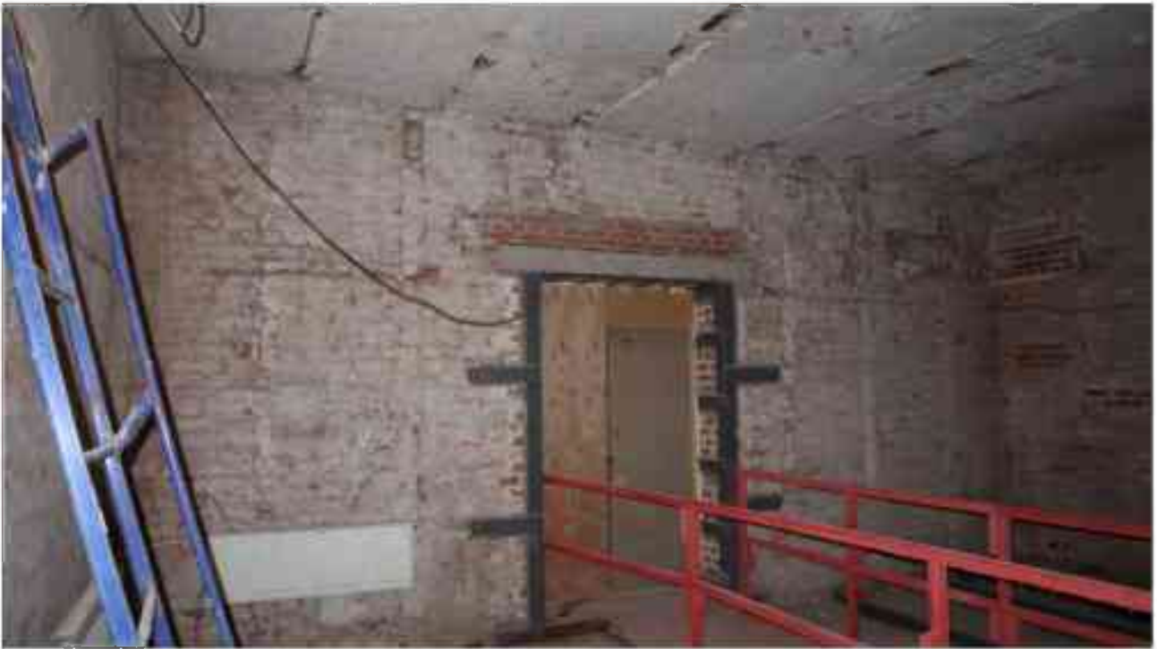
Фото 1.227. 1 этаж, помещение 15Н (4).
