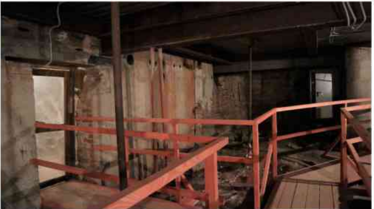
Фото п.27. Подвал, помещение 3Н (5).
