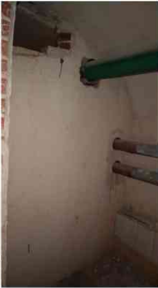
Фото п.199. Подвал, помещение 9Н (21).
