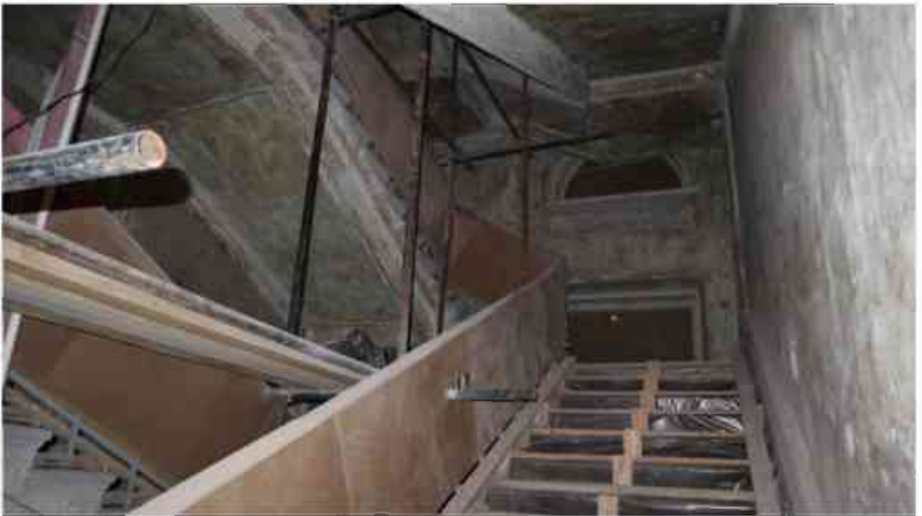
Фото 3.110. 3 этаж, лестница Л-10.
