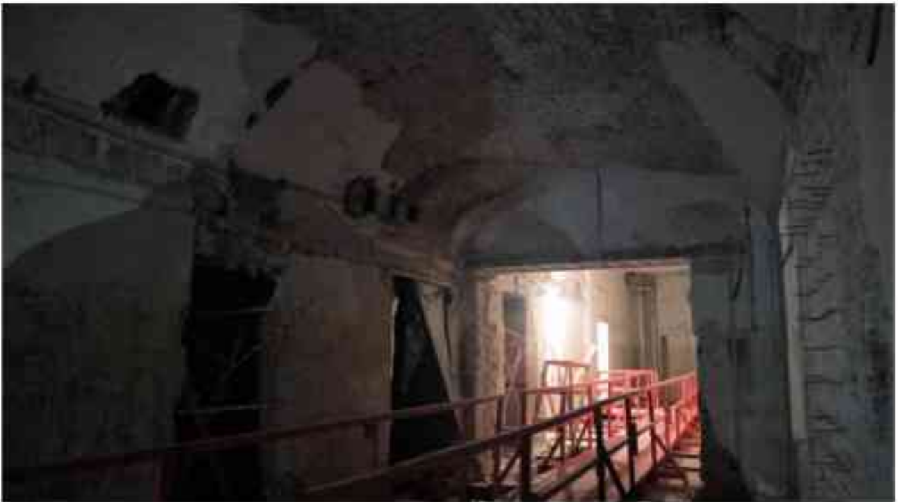
Фото 3.154. 3 этаж, помещение 23Н (8-9).
