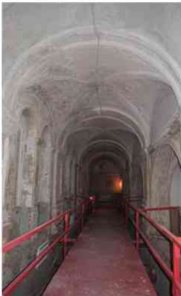
Фото 4.157. 4 этаж, помещение 30Н (4).
