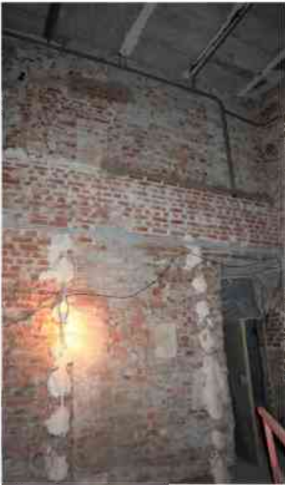
Фото п.57. Подвал, помещение ЗН (14).
