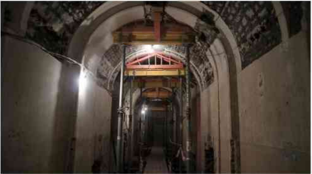
Фото 3.1. 3 этаж, помещение 28Н (48,19, 43).
