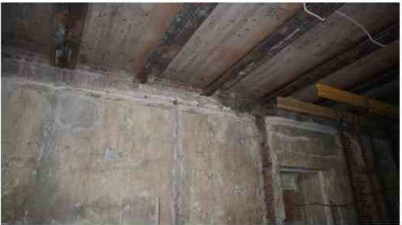
Фото 2.99. 2 этаж, помещение 22Н (33-35, 38-40).
