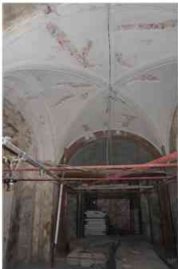
Фото 1.256. 1 этаж, помещение 13Н (15-16).
