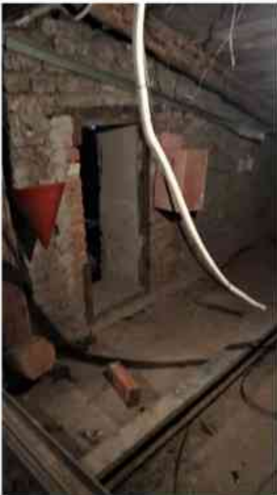
Фото 6.13. 6 этаж, чердачное помещение.
