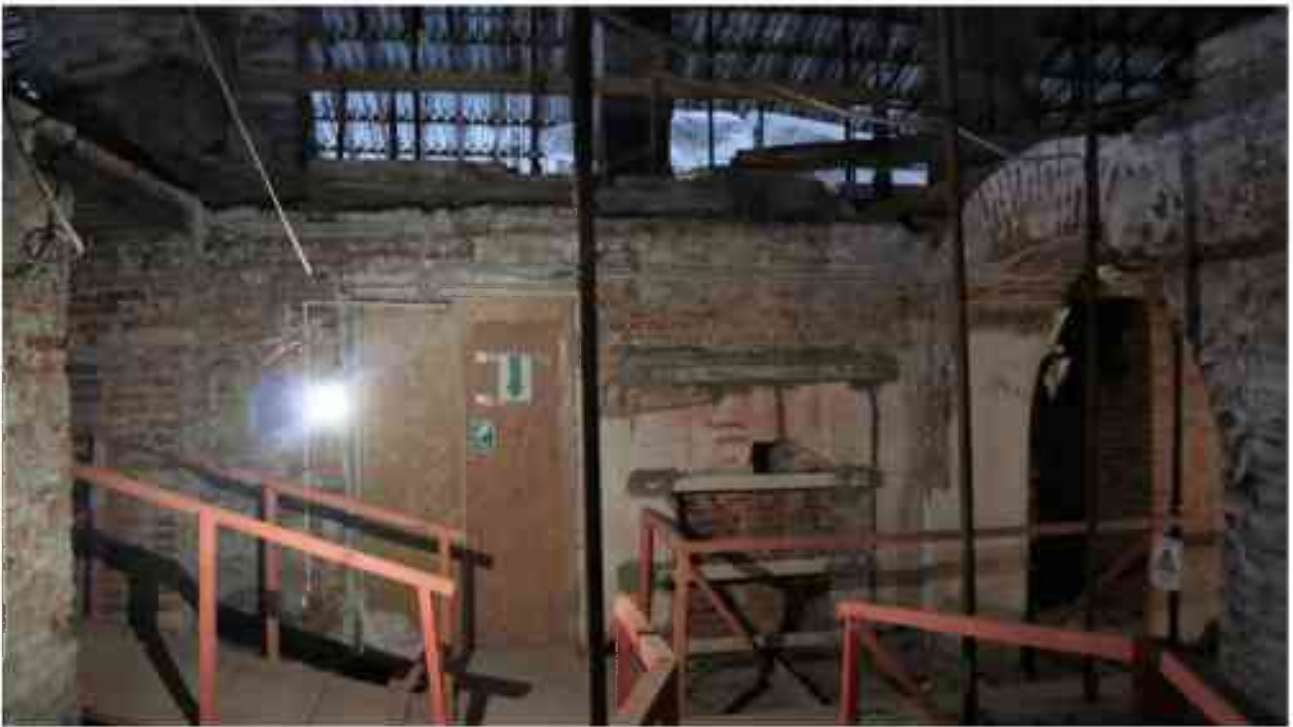
Фото 5.180. 5 этаж, коридор, помещения 34Н/37Н.
