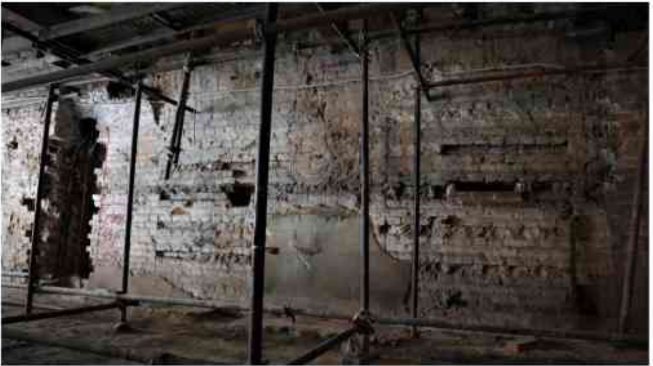
Фото 1.186. 1 этаж, помещение 17Н (1).
