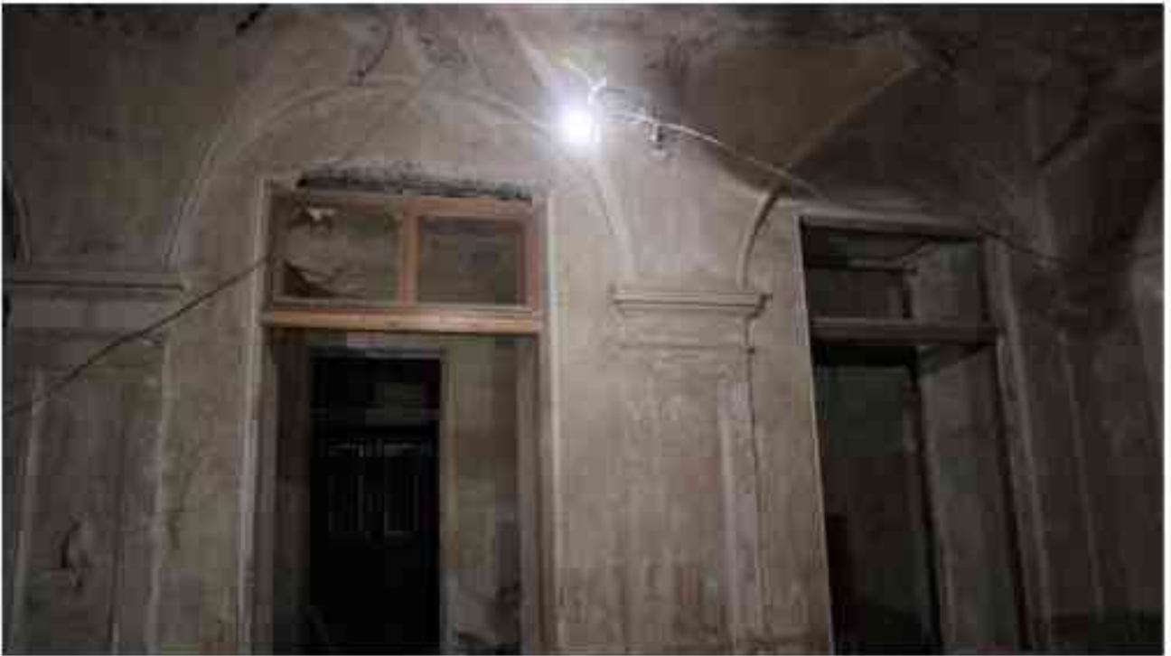
Фото 1.124. 1 этаж, помещение 31Н (2).
