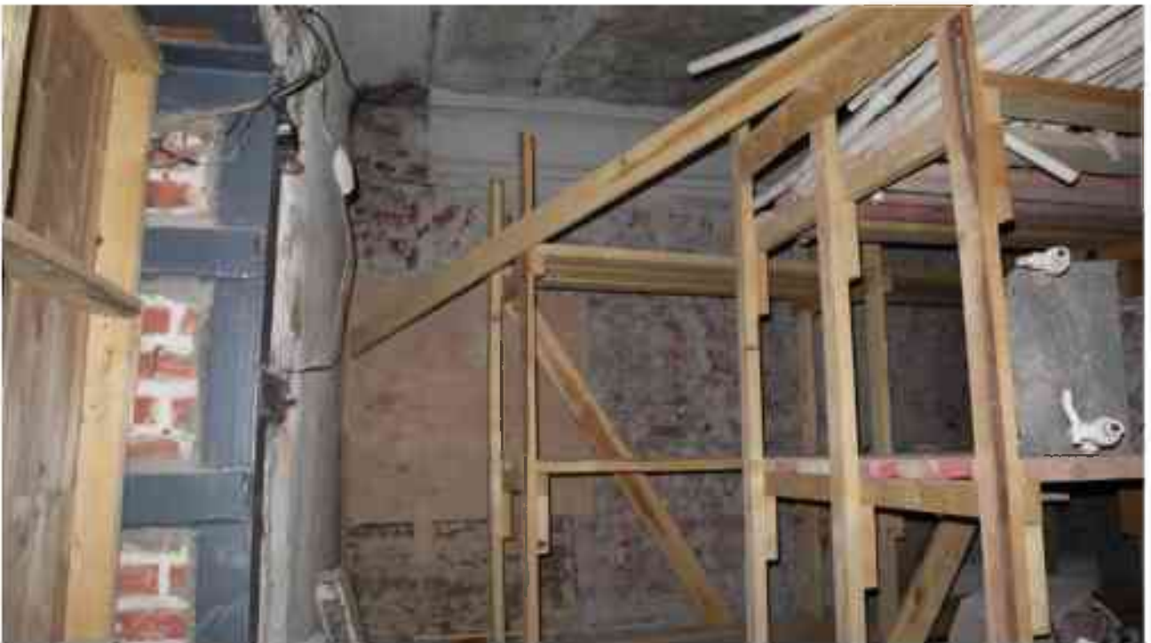
Фото 1.232. 1 этаж, помещение 15Н (3).
