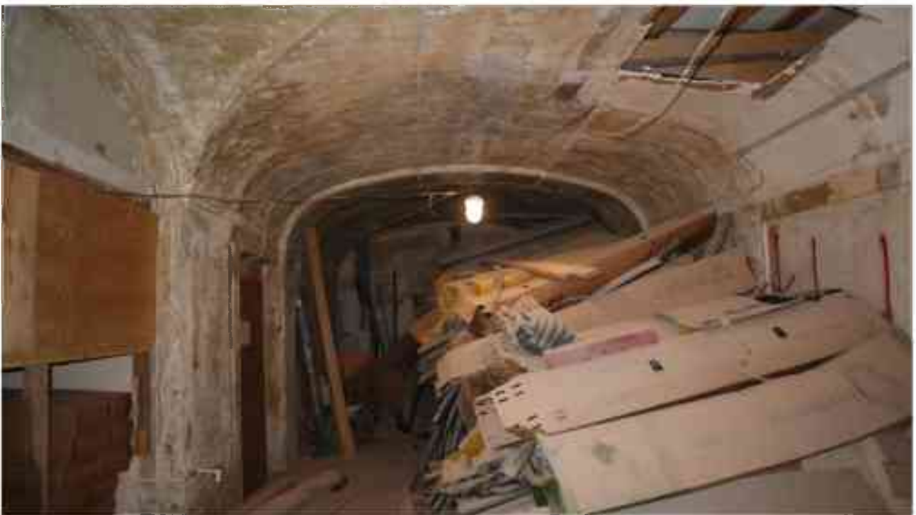
Фото 1.138. 1 этаж, помещение 31Н (11, 13-14).
