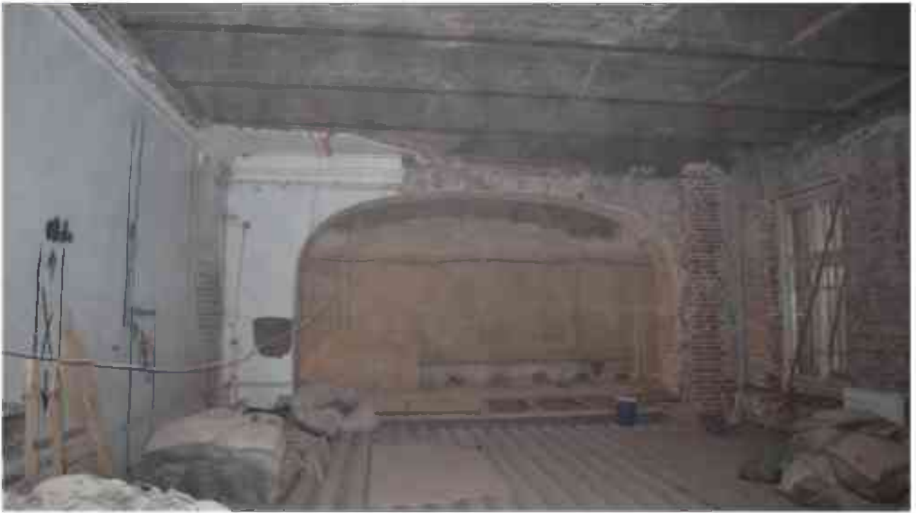
Фото 3.29. 3 этаж, помещение 28Н (29-35).
