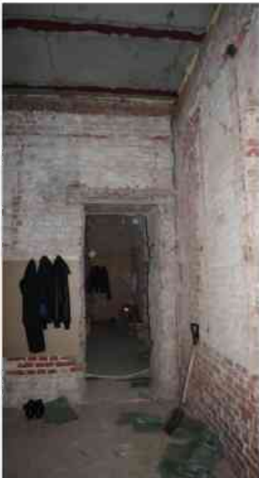
Фото 3.14. 3 этаж, помещение 28Н (38-39).
