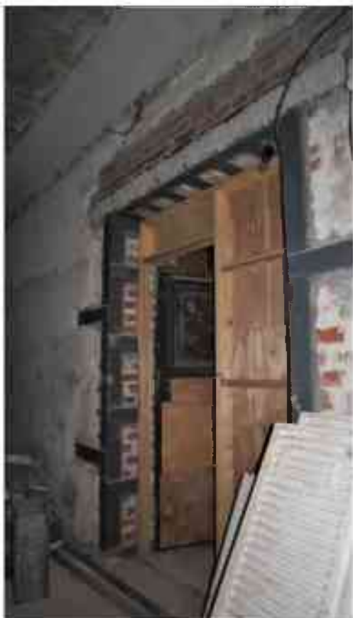
Фото 1.235. 1 этаж, помещение 15Н (3).
