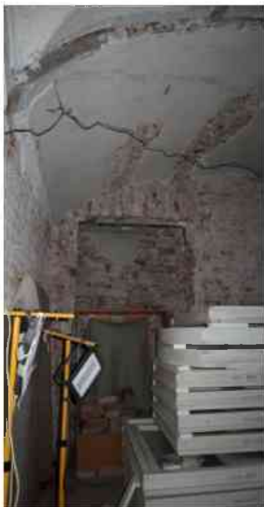
Фото 1.80. 1 этаж, помещение 14Н (27-28, 45).
