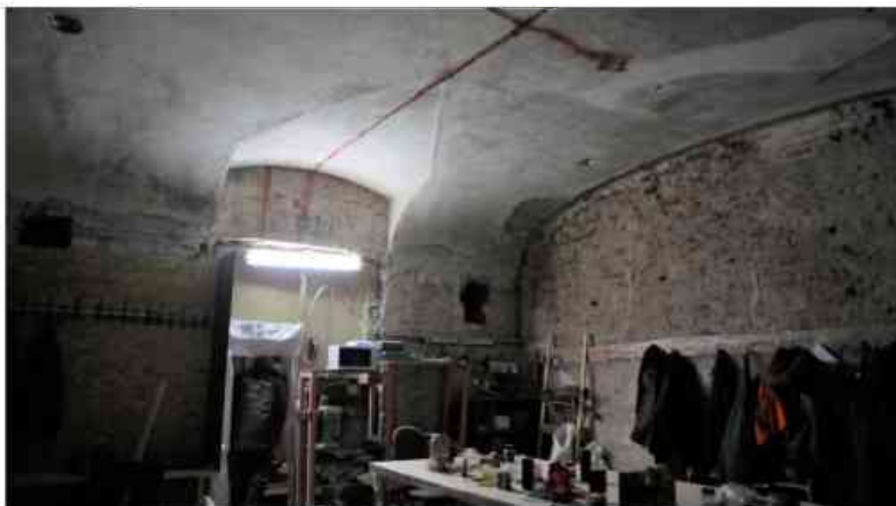
Фото 2.49. 2 этаж, помещение 22Н (62).
