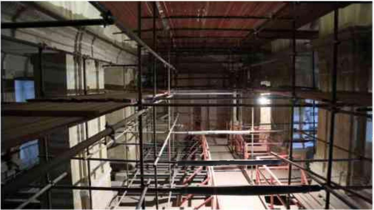
Фото 2.155. 2 этаж, помещение 22Н (19).*
