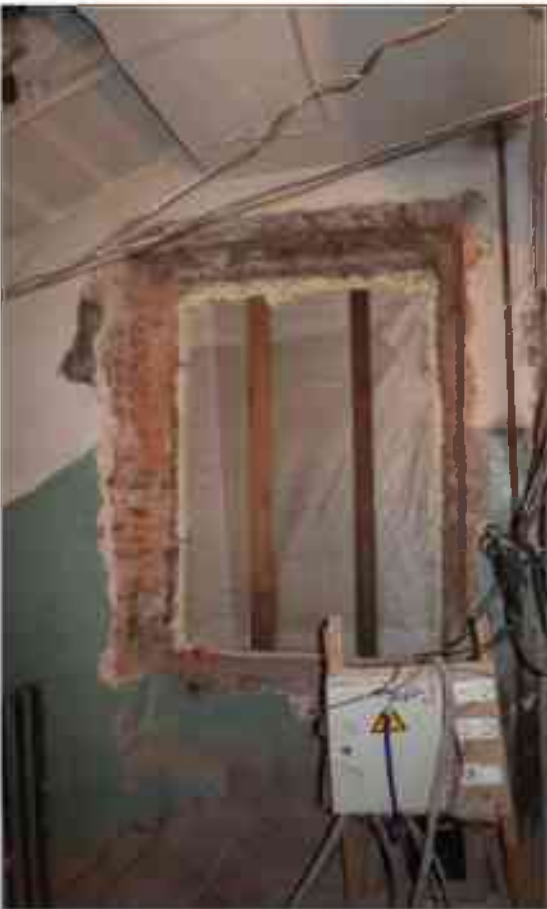
Фото 4.188. 4 этаж, лестница Л-3.
