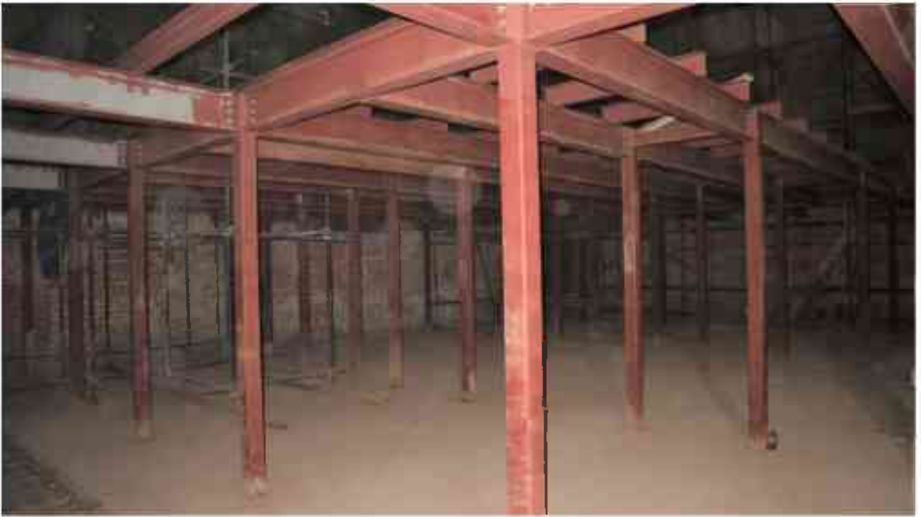
Фото 1.184. 1 этаж, помещение 17Н (1).
