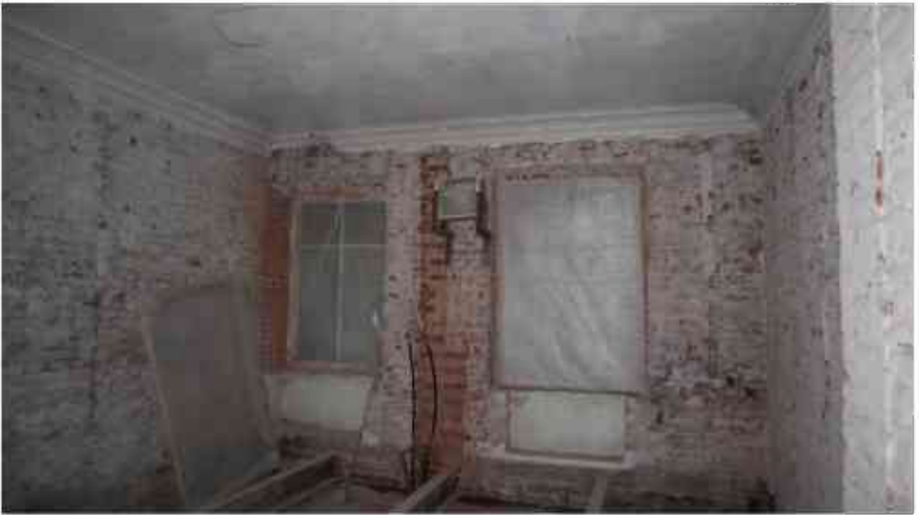
Фото 4.53. 4 этаж, помещение 33Н (29).
