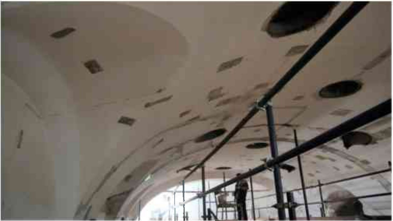
Фото 3.54. 3 этаж, помещение 28Н (20-21).*
