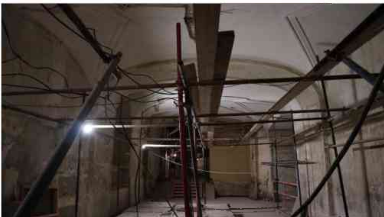
Фото 1.335. 1 этаж, помещение 13Н (30).
