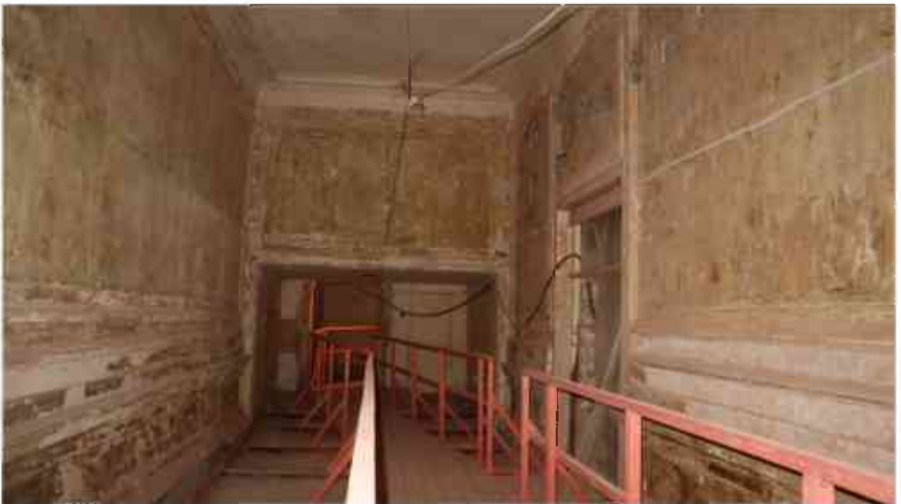
Фото 2.85. 2 этаж, помещение 22Н (28, 85).
