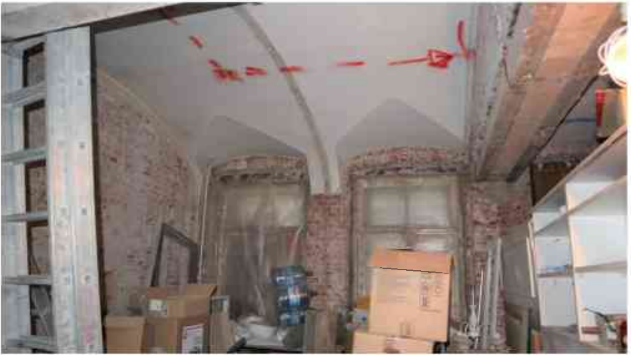
Фото 1.43. 1 этаж, помещение 14Н (6).
