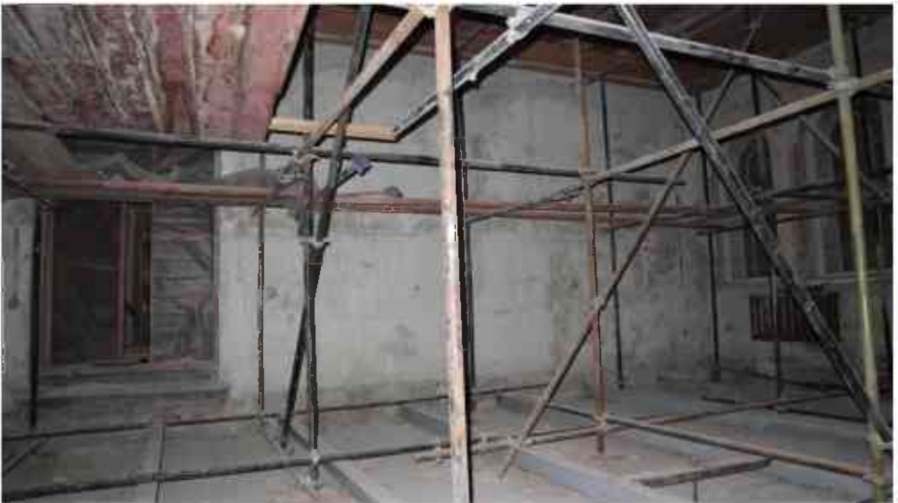
Фото 4.144. 4 этаж, помещение 30Н (12).
