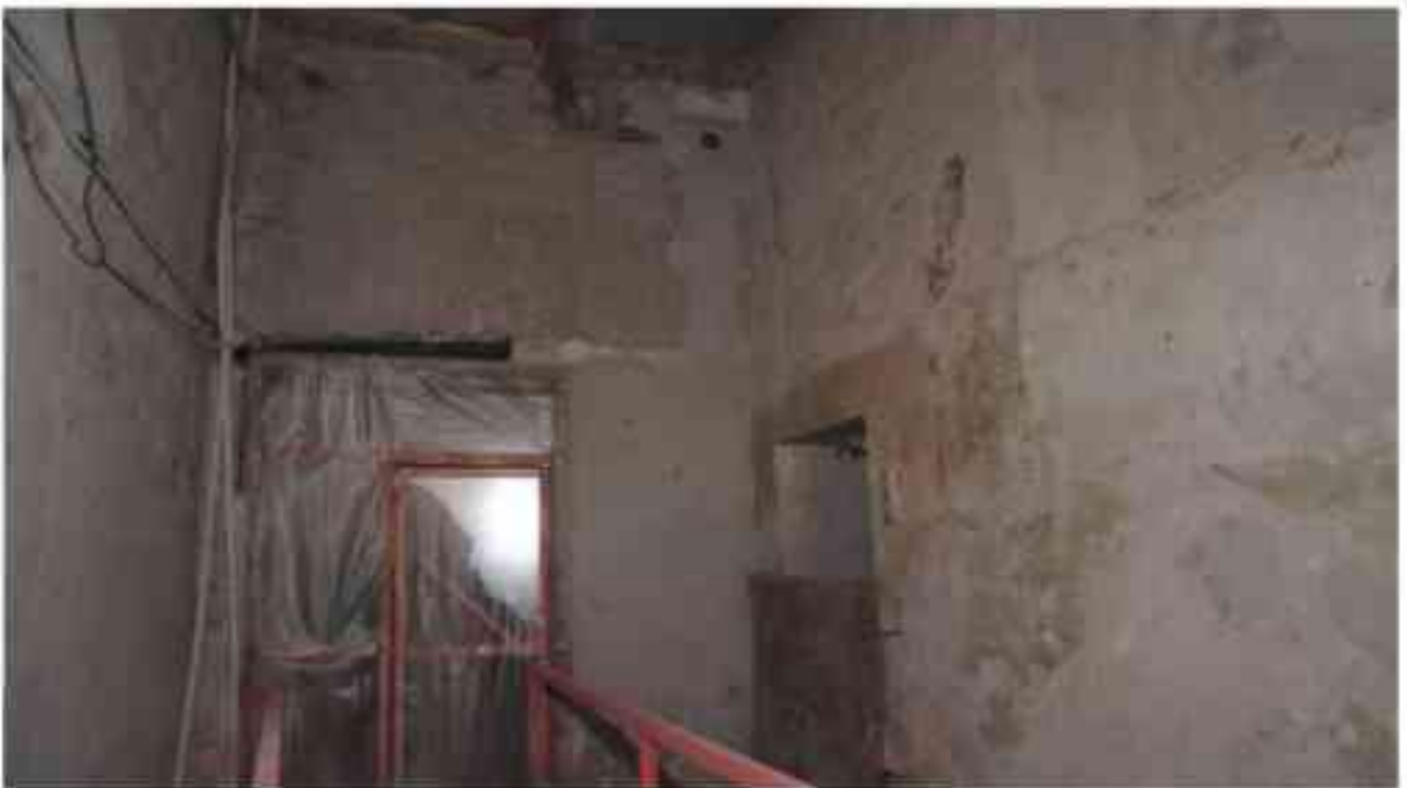
Фото 3.162. 3 этаж, помещение 23Н (7).
