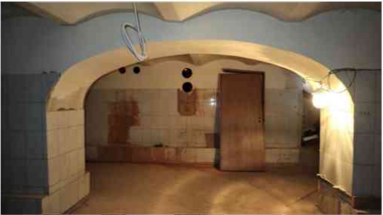
Фото п.281. Подвал, помещение 6Н (9, 13).
