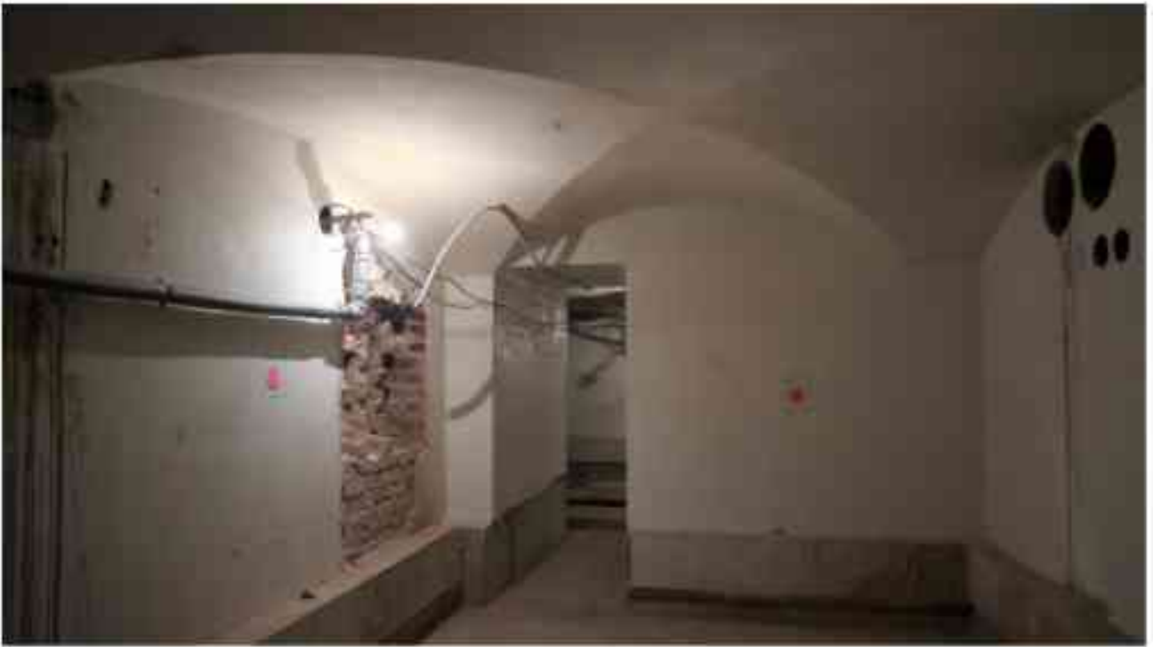
Фото п.258. Подвал, помещение 6Н (4).
