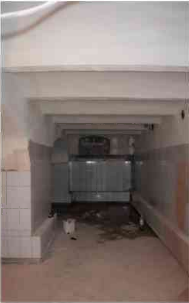
Фото п.282. Подвал, помещение 6Н (13-14).
