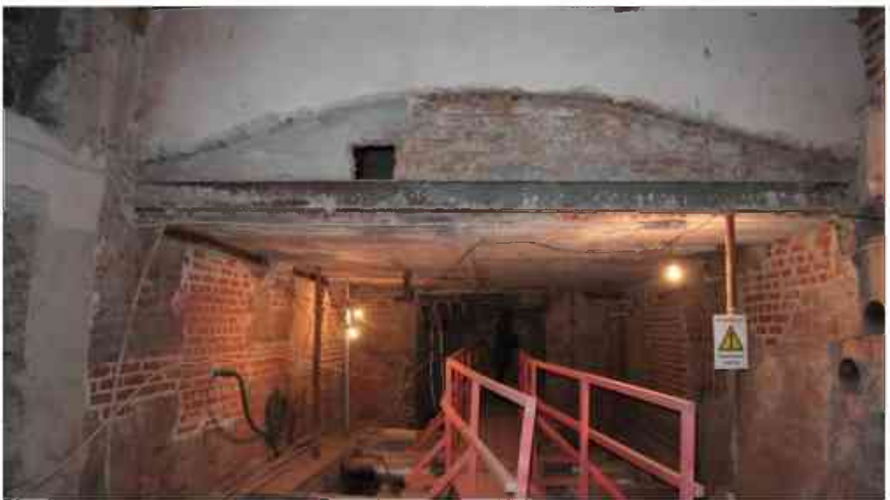
Фото п.335. Подвал, помещение 18Н (3-4).
