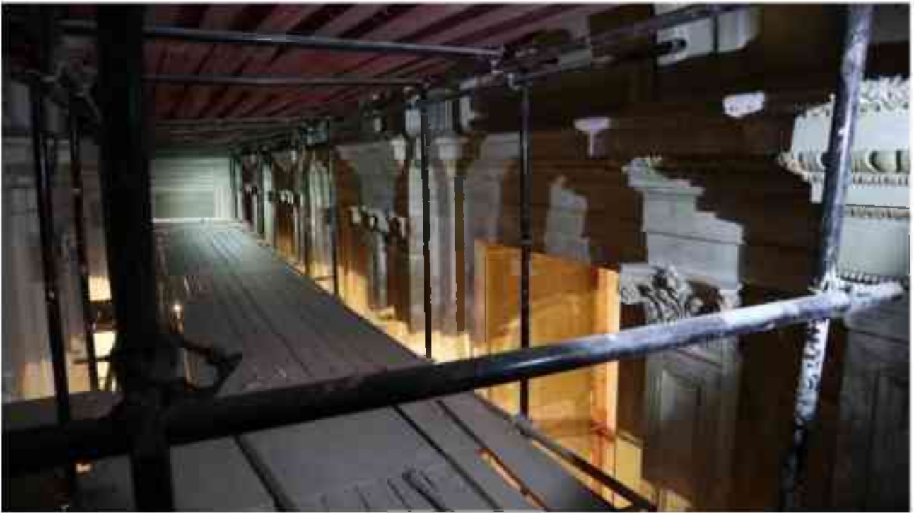
Фото 2.139. 2 этаж, помещение 22Н (19).*
