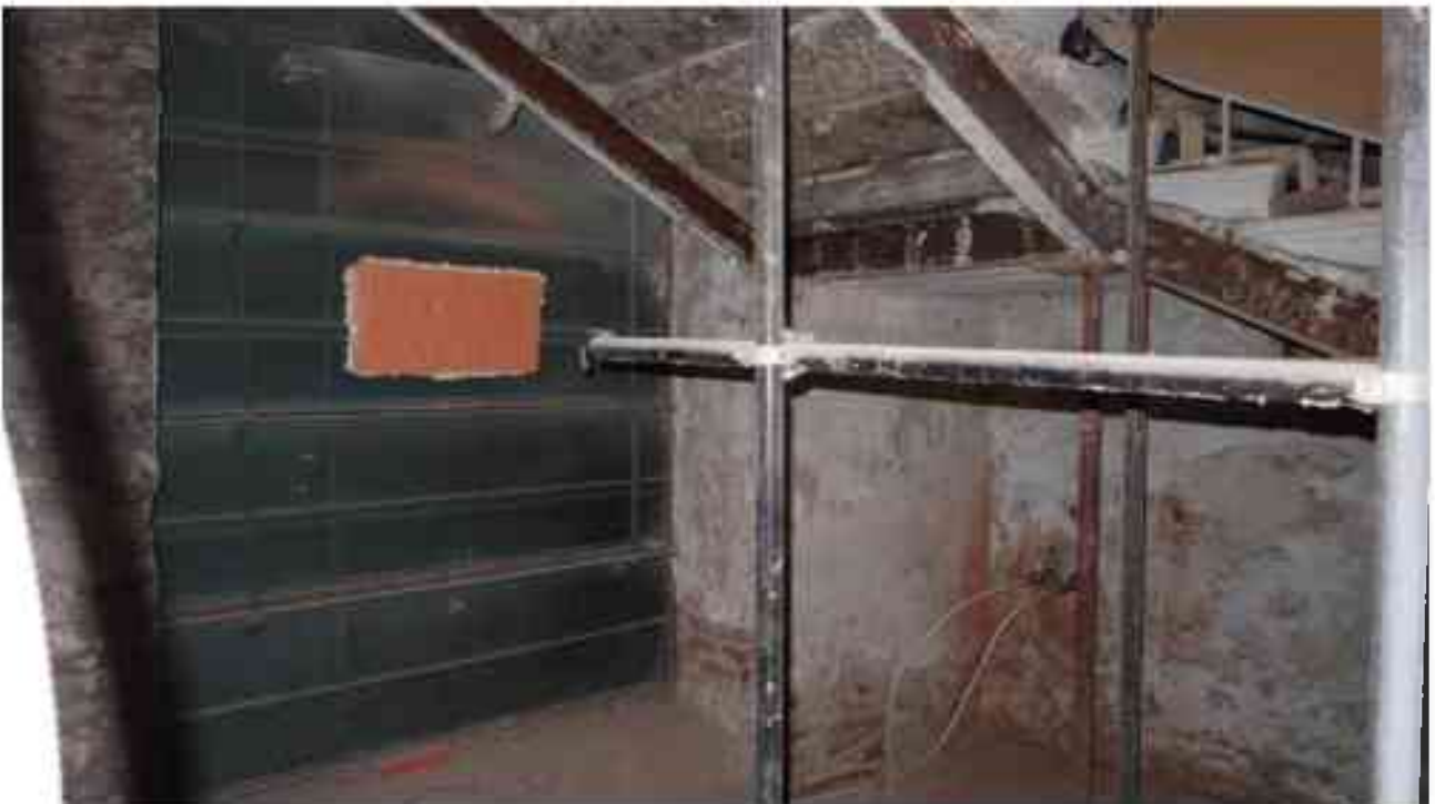
Фото 1.222. 1 этаж, лестница Л-7.
