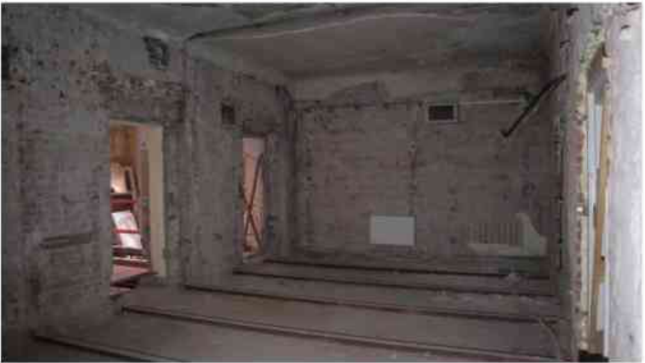
Фото 3.159. 3 этаж, помещение 23Н (1-6).
