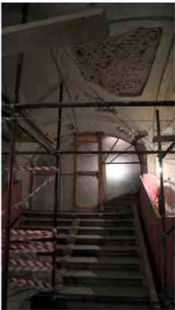
Фото 1.332. 1 этаж, помещение 13Н (30).
