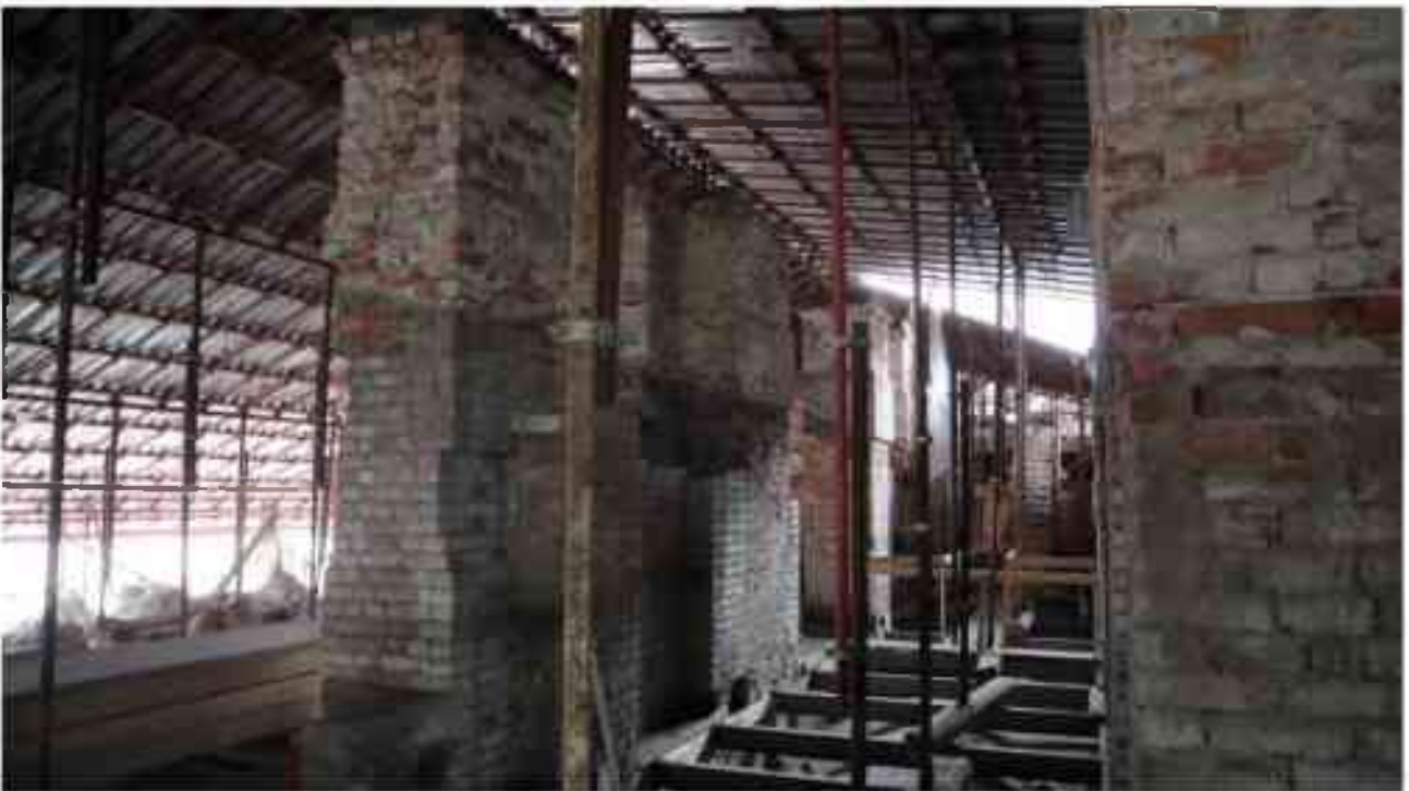
Фото 6.37. 6 этаж, чердачное помещение.
