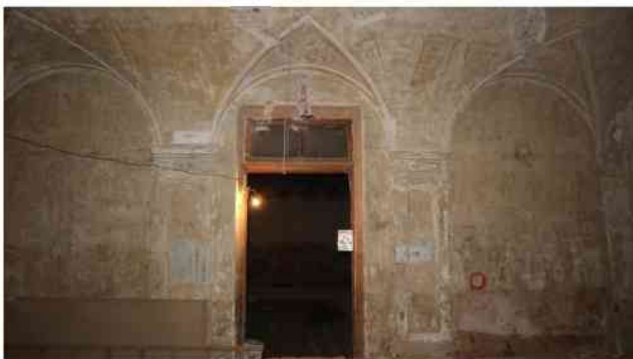
Фото 1.127. 1 этаж, помещение 31Н (1).
