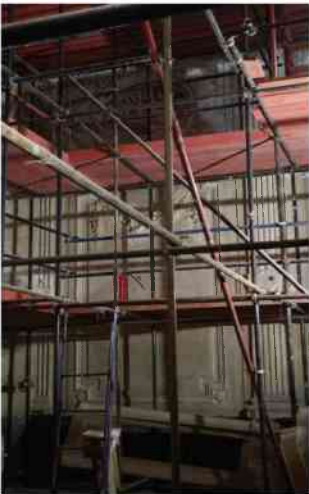
Фото 3.74. 3 этаж, помещение 28Н (2).
