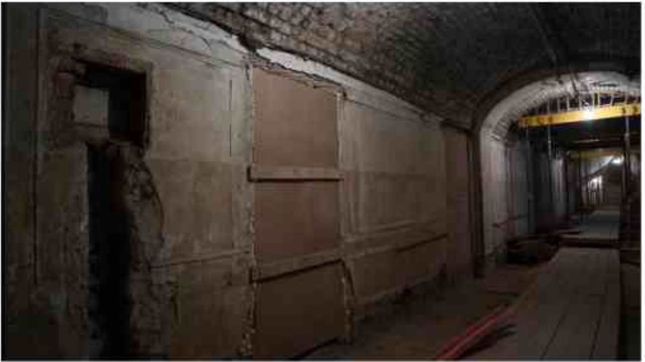
Фото 4.47. 4 этаж, помещение 33Н (22).
