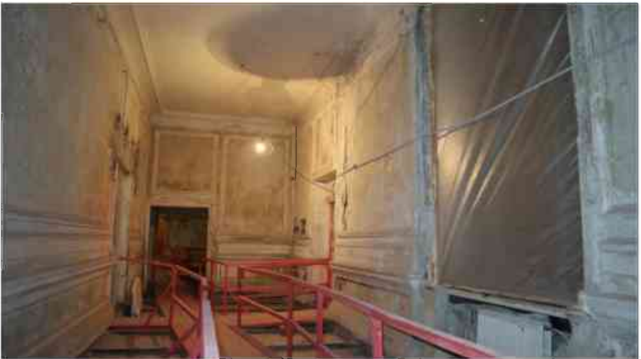
Фото 2.173. 2 этаж, помещение 22Н (17).
