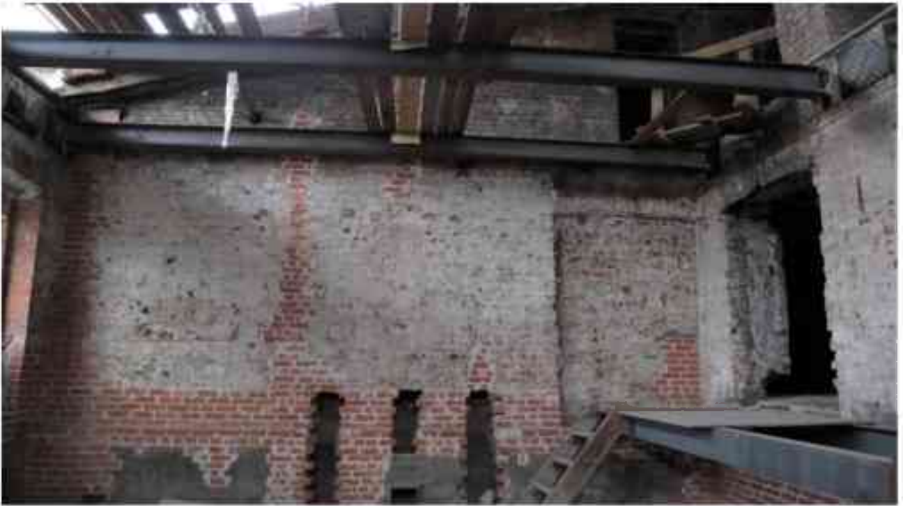
Фото 5.142. 5 этаж, жилой блок, на плане ПИБ 2000г. обозначен как квартиры, помещение (9-19).
