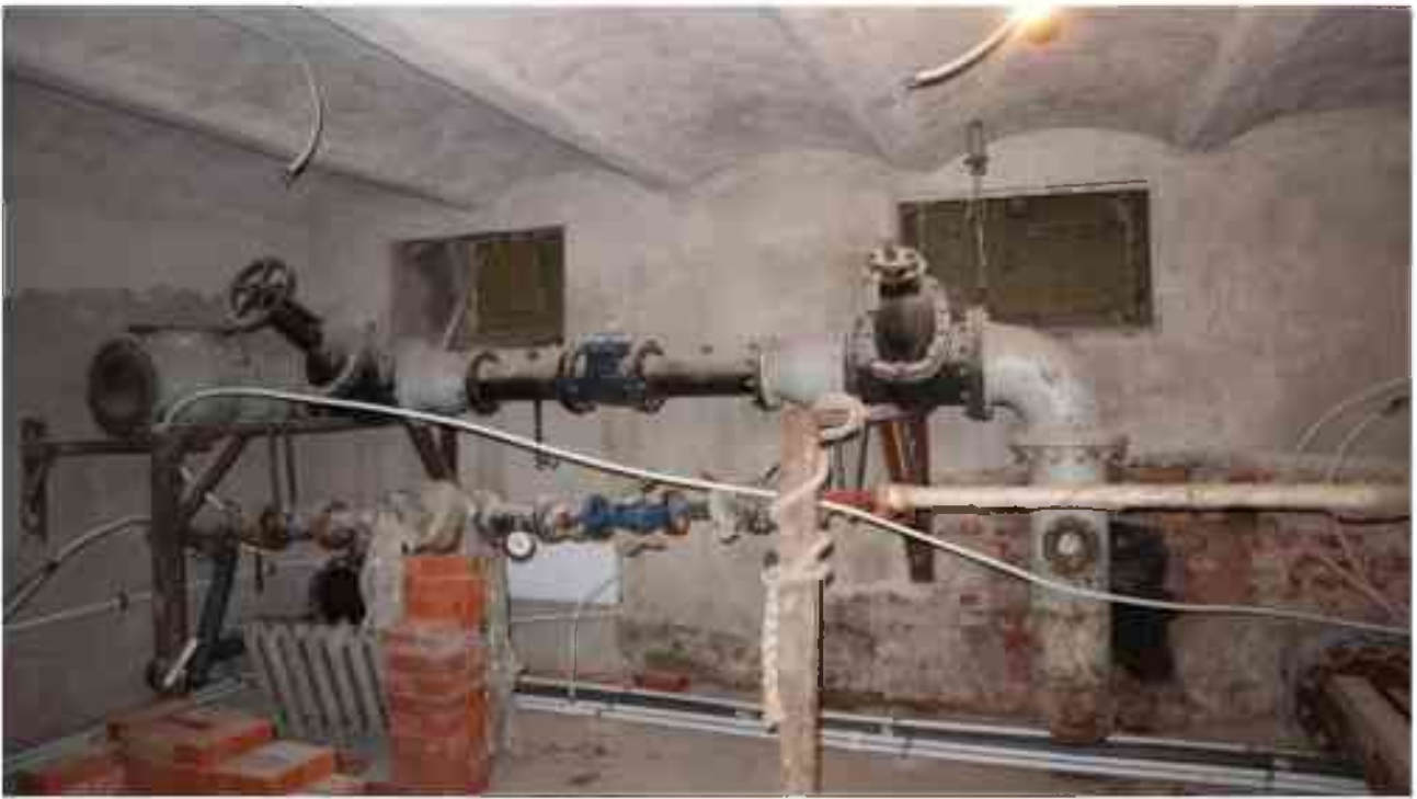
Фото п.9. Подвал, помещение 2Н (2).
