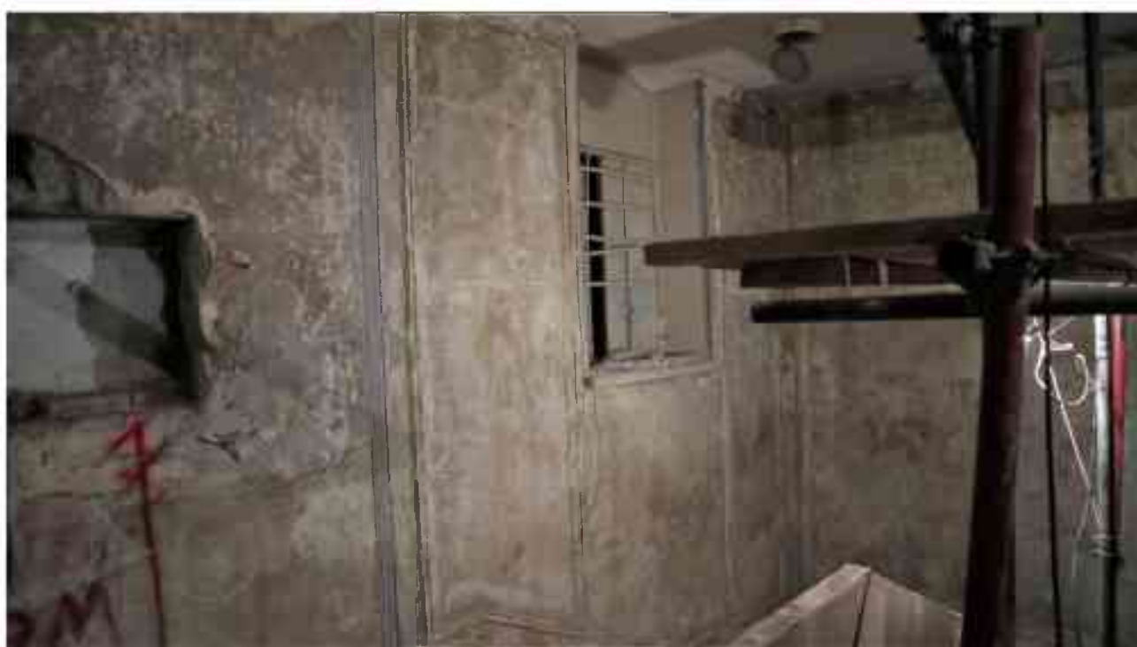
Фото 4.177. 4 этаж, лестница Л-13.
