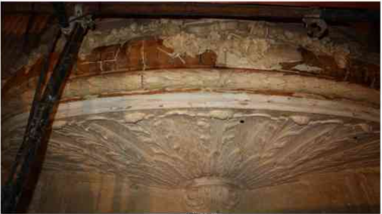
Фото 3.79. 3 этаж, помещение 28Н (2).*
