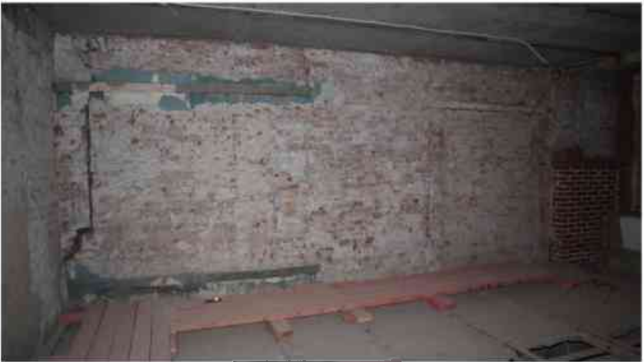
Фото 4.196. 4 этаж, помещение 42Н* (5-7).
