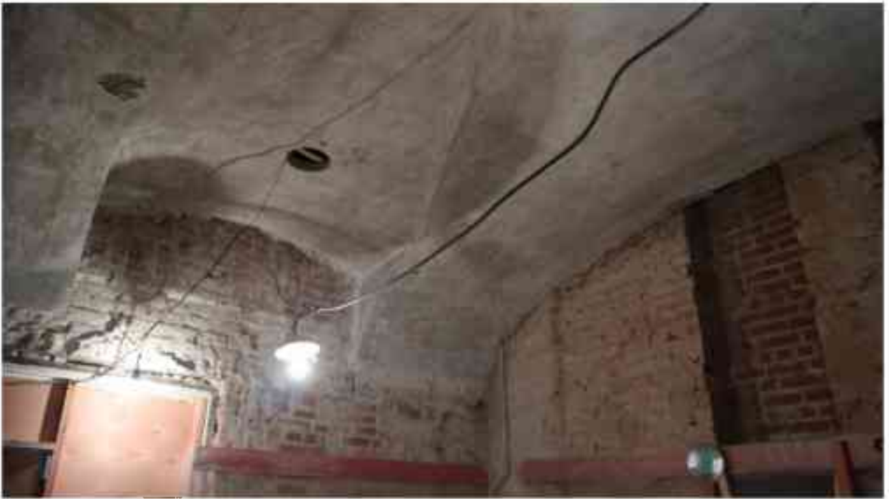
Фото 2.51. 2 этаж, помещение 22Н (61).
