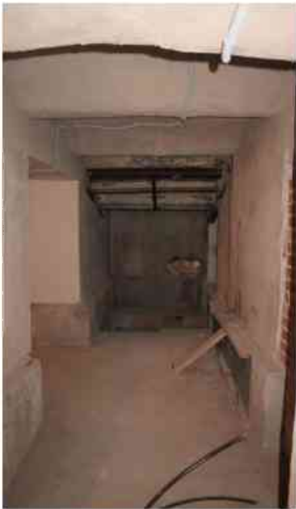
Фото п.205. Подвал, помещение 9Н (5).
