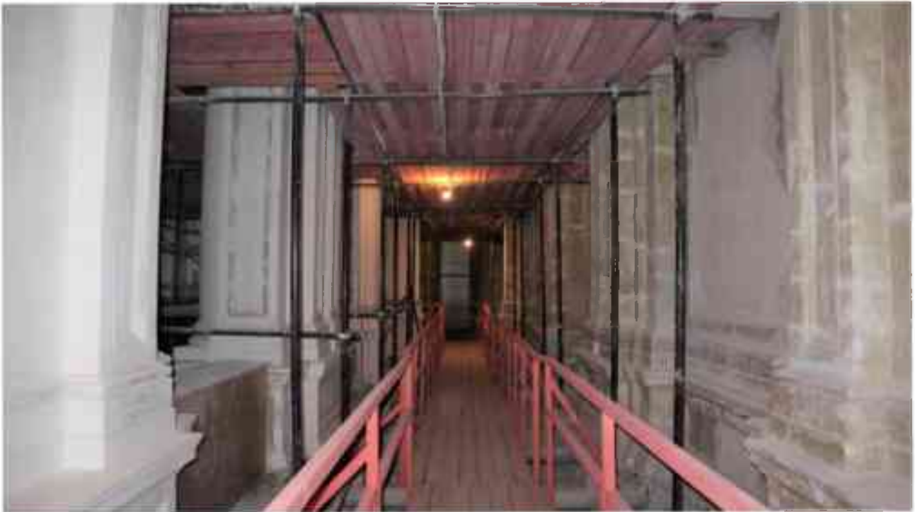
Фото 2.129. 2 этаж, помещение 22Н (19).
