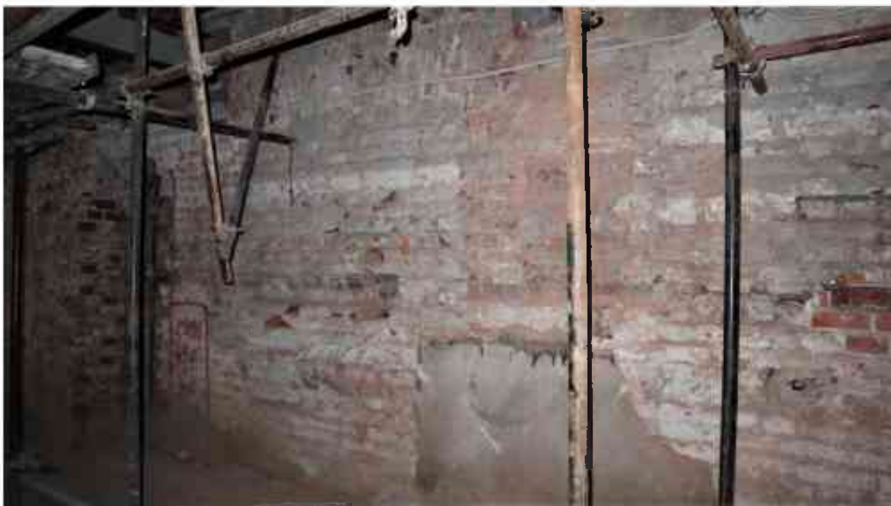
Фото 1.183. 1 этаж, помещение 17Н (1).
