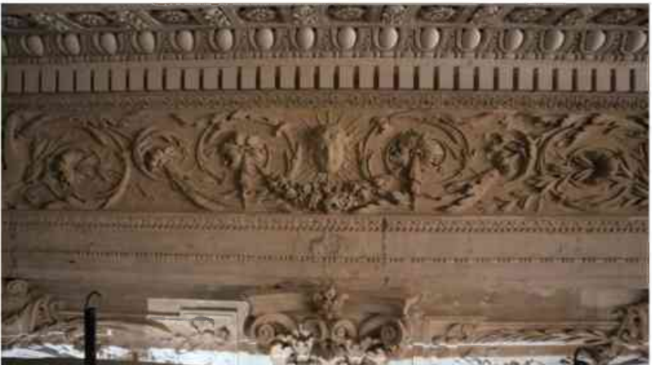
Фото 3.86. 3 этаж, помещение 28Н (2).*
