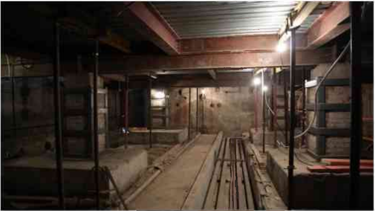
Фото п.30. Подвал, помещение 3Н (5-8).
