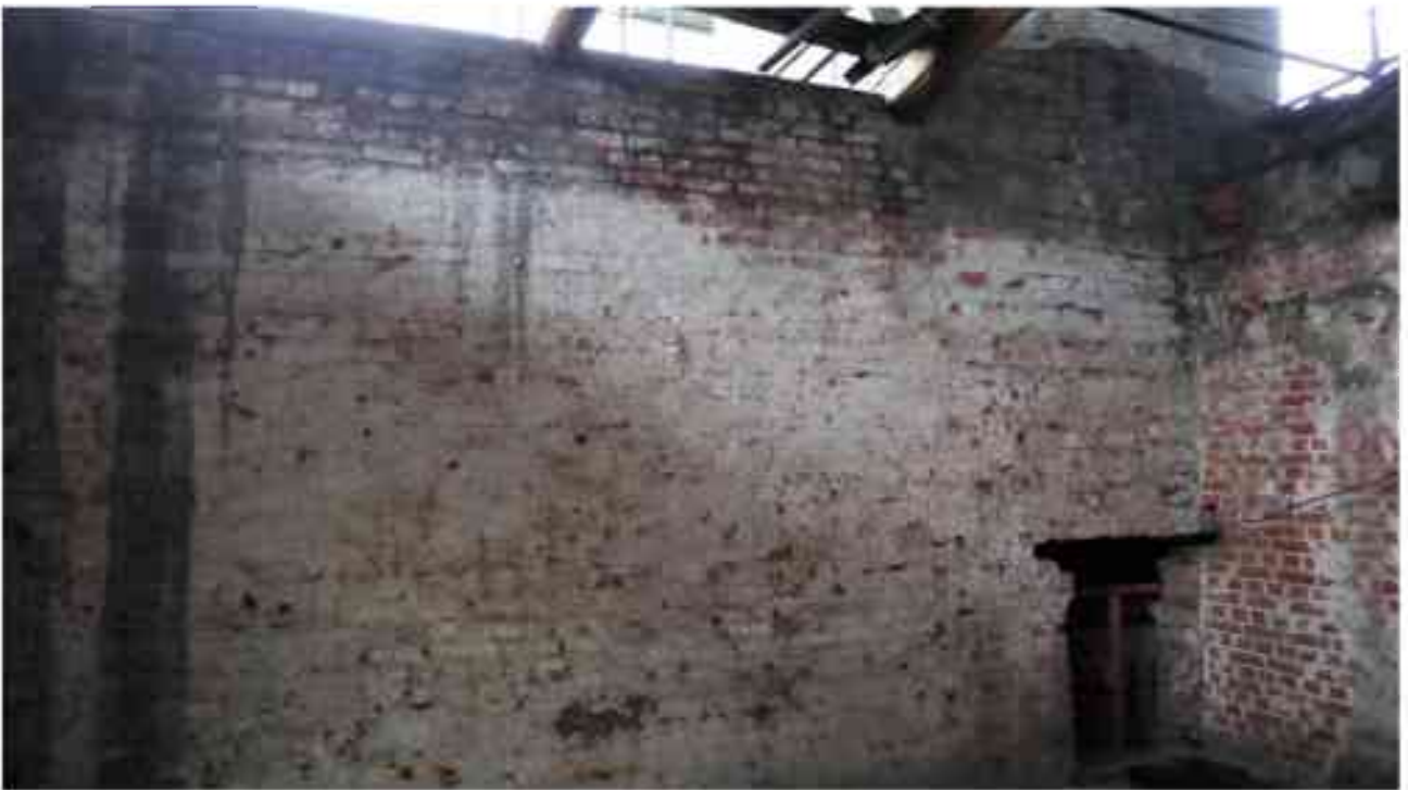
Фото 5.139. 5 этаж, жилой блок, на плане ПИБ 2000г. обозначен как квартиры, помещение (7-8).
