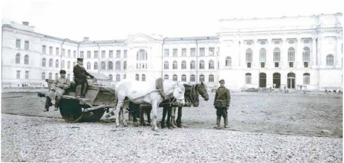
Илл. 18. Общий вид главного корпуса Политехнического института в процессе строительства. 1902 г. // https://pastvu.com/p/723799
