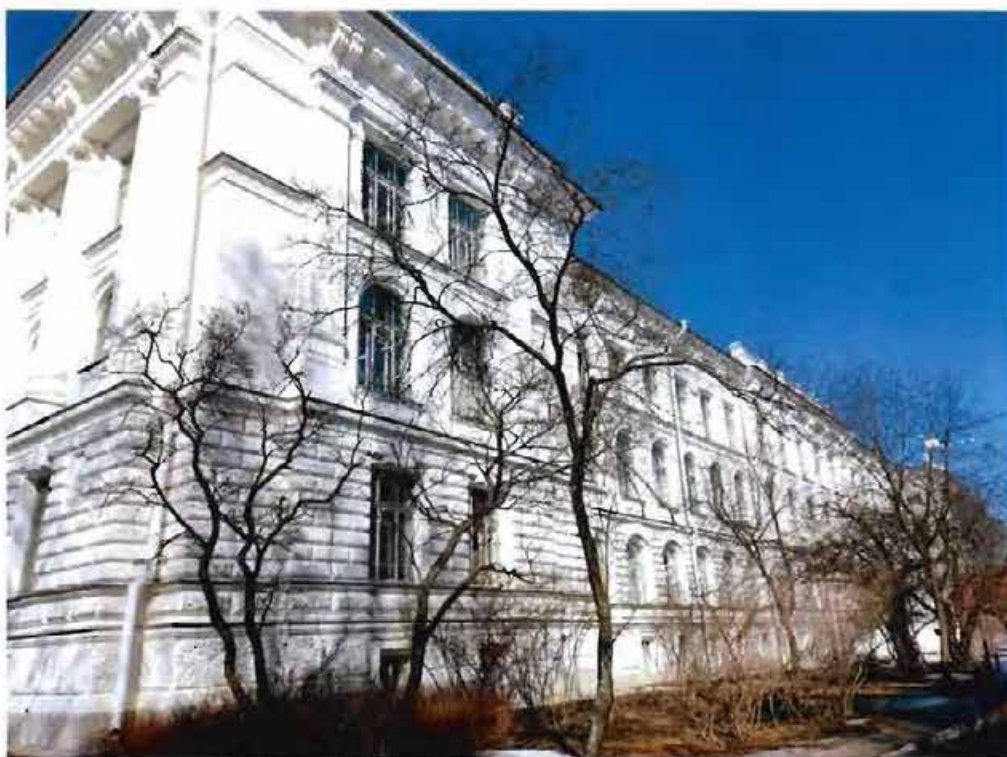
3. Восточный корпус (фрагмент), вид с юга.
