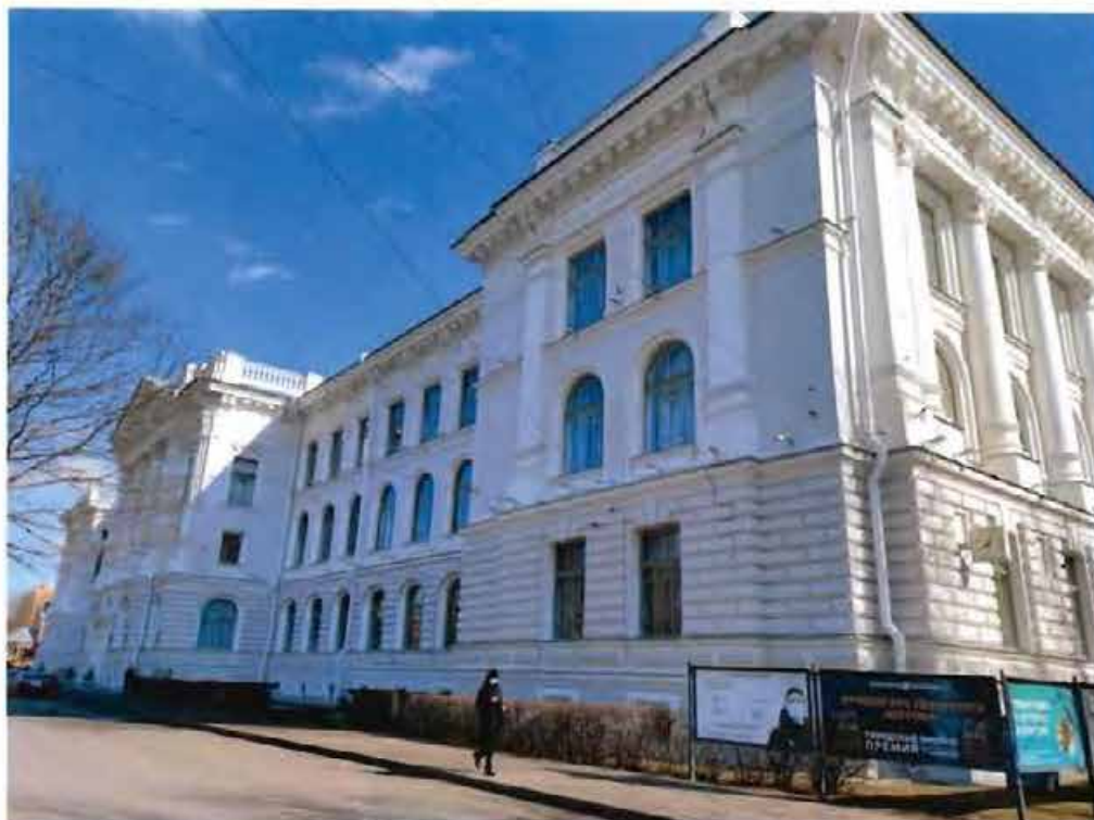
2. Западный корпус, вид с юга.
