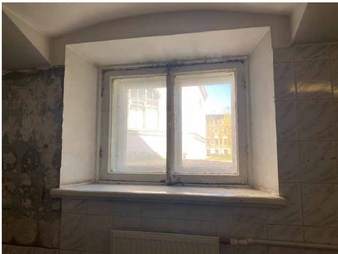
48. Фрагмент интерьера цокольного этажа. Историческое окно.
