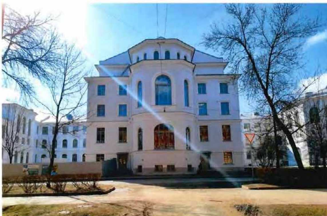
5. Дворовой фасад (фрагмент), вид с севера.
