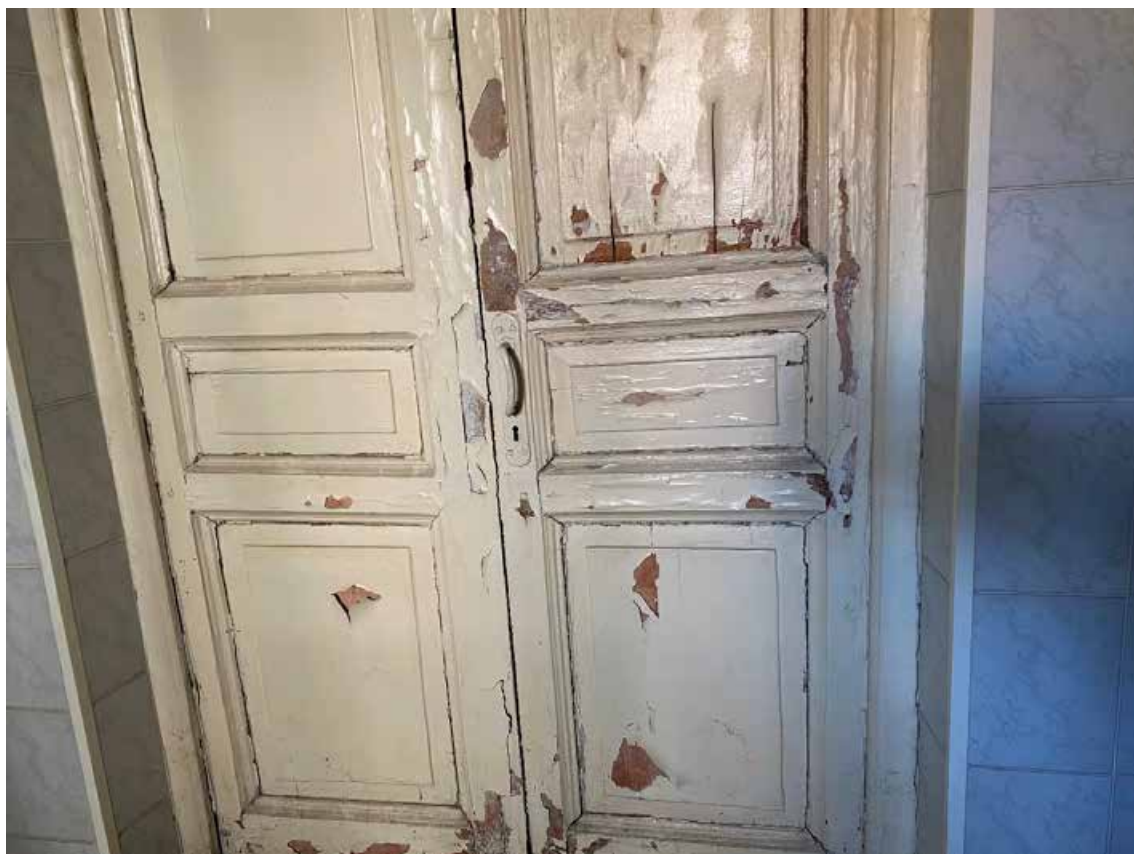
67. Фрагмент интерьера цокольного этажа. Историческая дверь.
