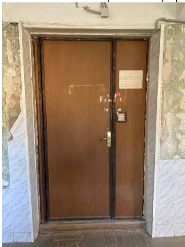
46. Фрагмент интерьера цокольного этажа. Дверной проем.
