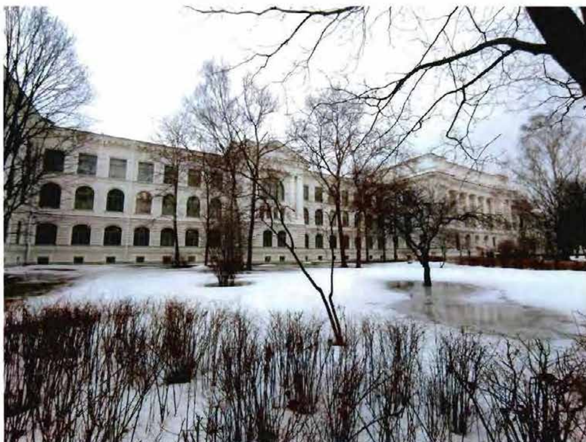
1. Общий вид с юго-запада.
