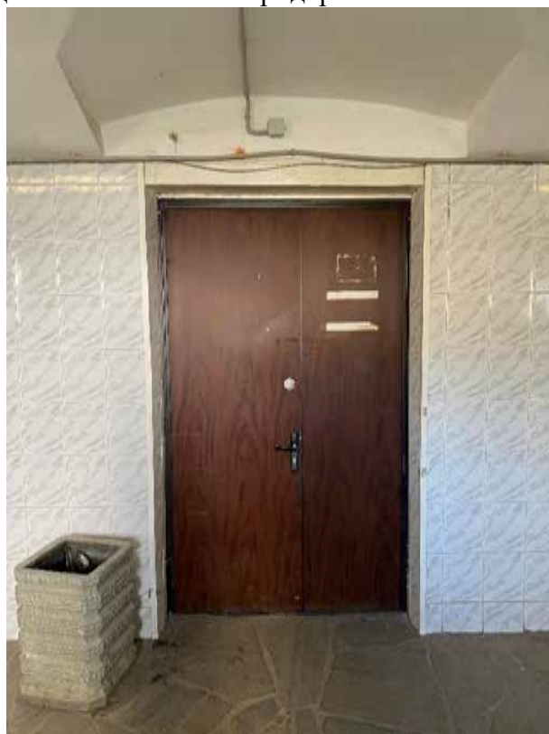
47. Фрагмент интерьера цокольного этажа. Дверной проем.
