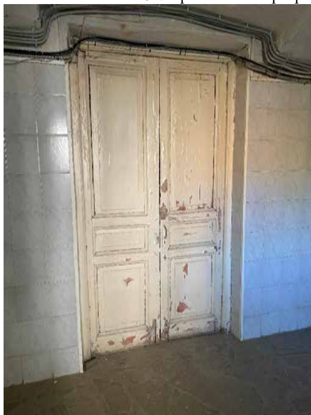
65. Фрагмент интерьера цокольного этажа. Историческая дверь.
