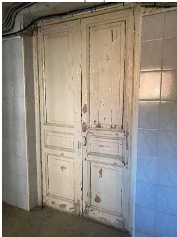
66. Фрагмент интерьера цокольного этажа. Историческая дверь.
