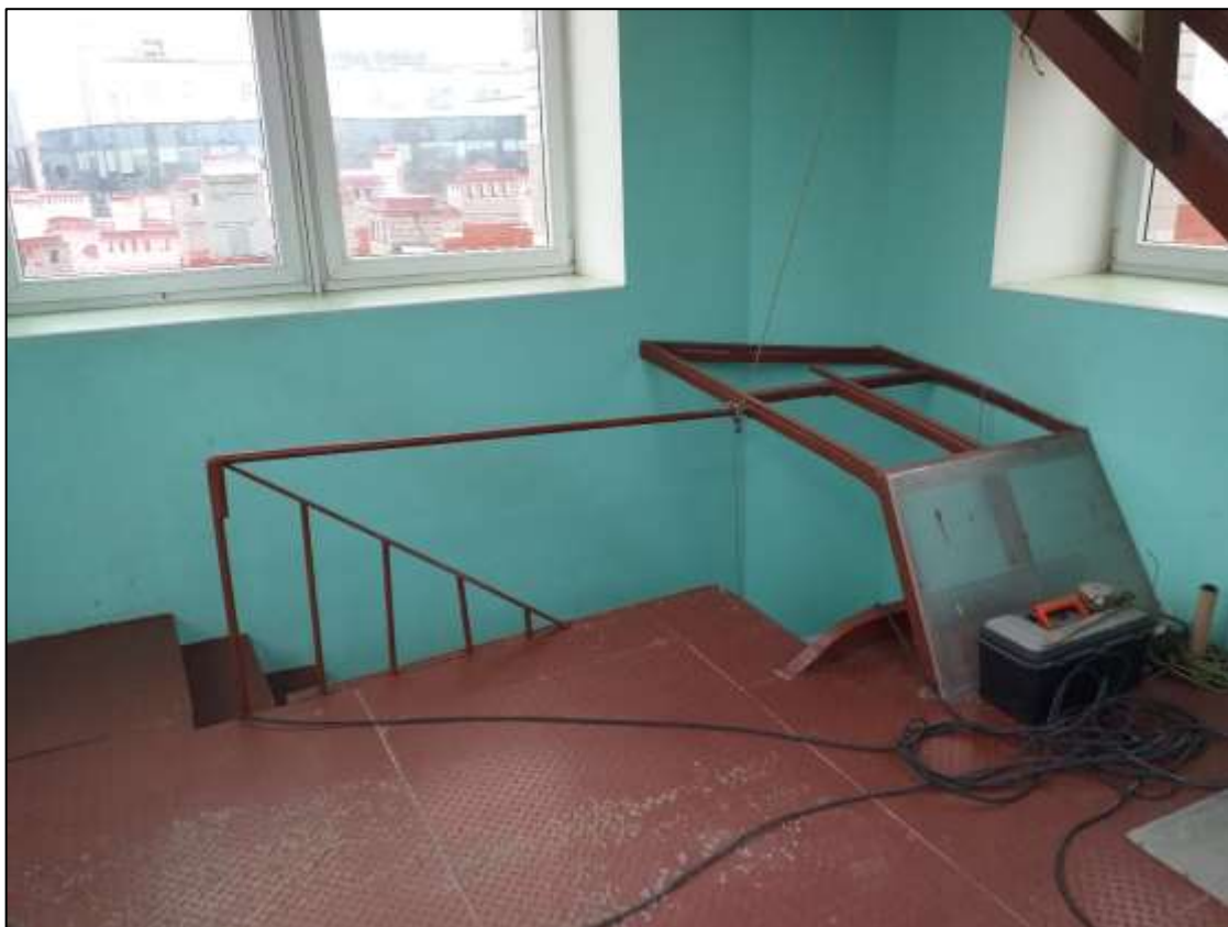
9. Колокольня Иоанновского монастыря. Интерьер 2-го яруса. Вид с юго-запада. Фото Н.М.Петуховой 24.11.2021г.
