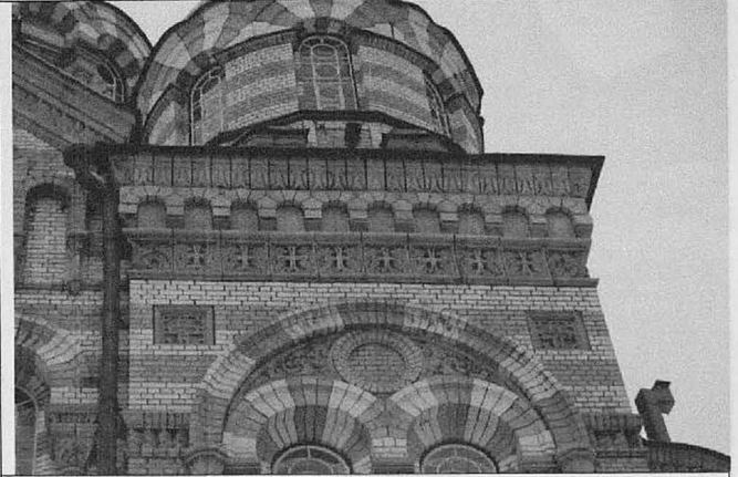
16. Главный корпус. Ризалит правого купола. Венчающий карниз.
