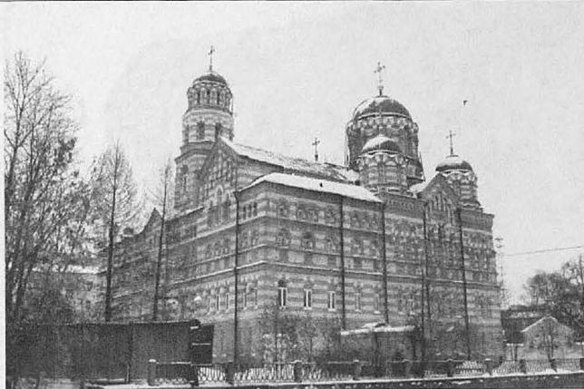
2. Вид с юго-запада.
