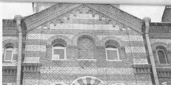
33. Западный фасад западного корпуса с колокольней. Щипец ризалита парадной лестницы.
