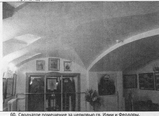
60. Сводчатое помещение за церковью св. Илии и Феодоры.
