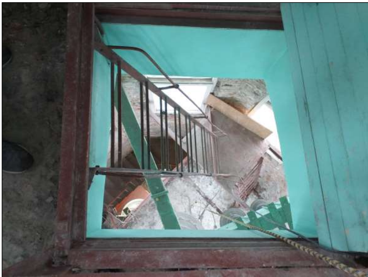
18. Лестница на 4-й ярус колокольни. Вид сверху. Фото Н.М.Петуховой.24.11.2021г.
