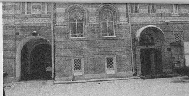
31. Западный фасад западного корпуса с колокольней.
