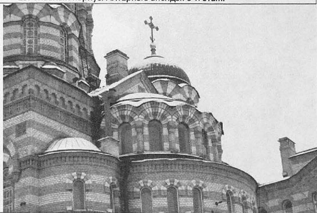
26. Главный корпус. Алтарные апсиды. 2-й ярус главной апсиды.
